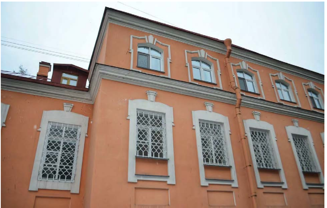
Фото 21. ОКН федерального значения «Корпус просфорный с северными воротами главного двора» (наб. реки Монастырки, дом 1, литера Г). Северо-западный фасад. Фрагмент. Съёмка 28.10.2020 г.
