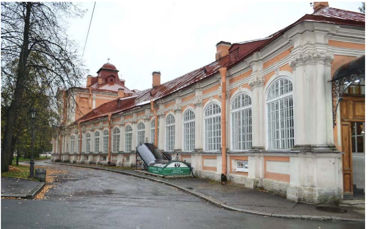
Фото 44. ОКН федерального значения «Корпус просфорный с северными воротами главного двора» (наб. реки Монастырки, дом 1, литера Г). Юго-восточный фасад. Фрагмент. Съёмка 28.10.2020 г.
