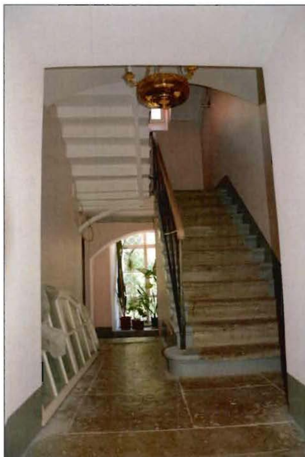
8. Лестница в северо-восточной части здания.
