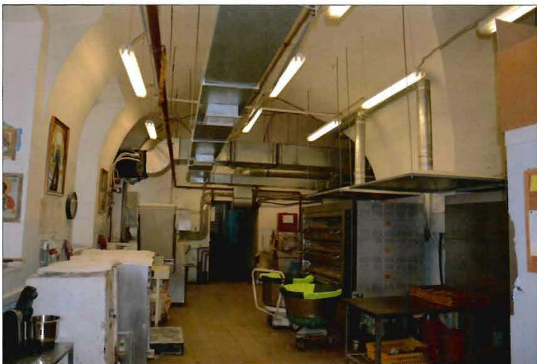
6. Сводчатые перекрытия в уровне цокольного этажа.
