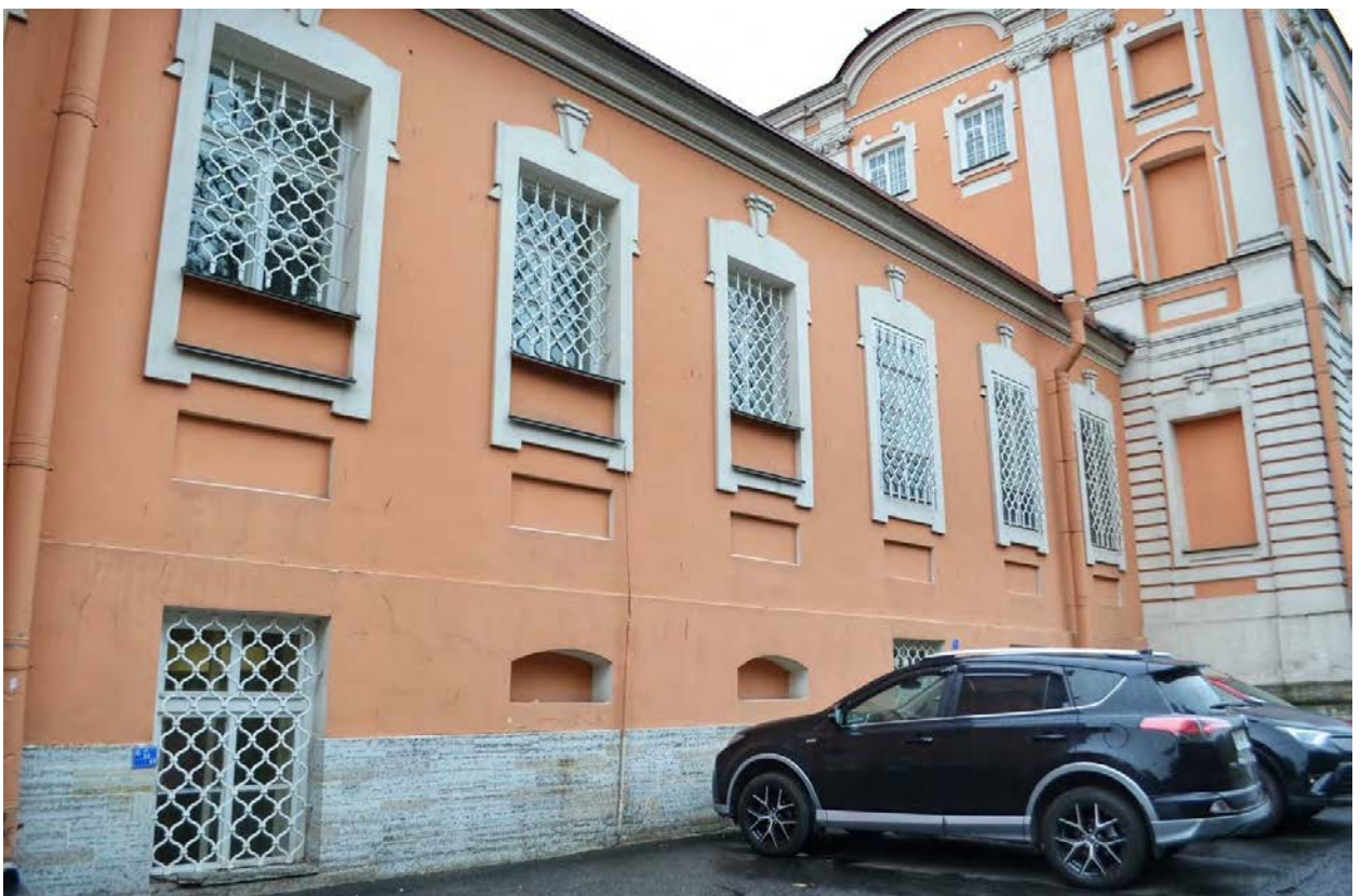
Фото 27. ОКН федерального значения «Корпус просфорный с северными воротами главного двора» (наб. реки Монастырки, дом 1, литера Г). Северо-западный фасад. Фрагмент. Съёмка 28.10.2020 г.
