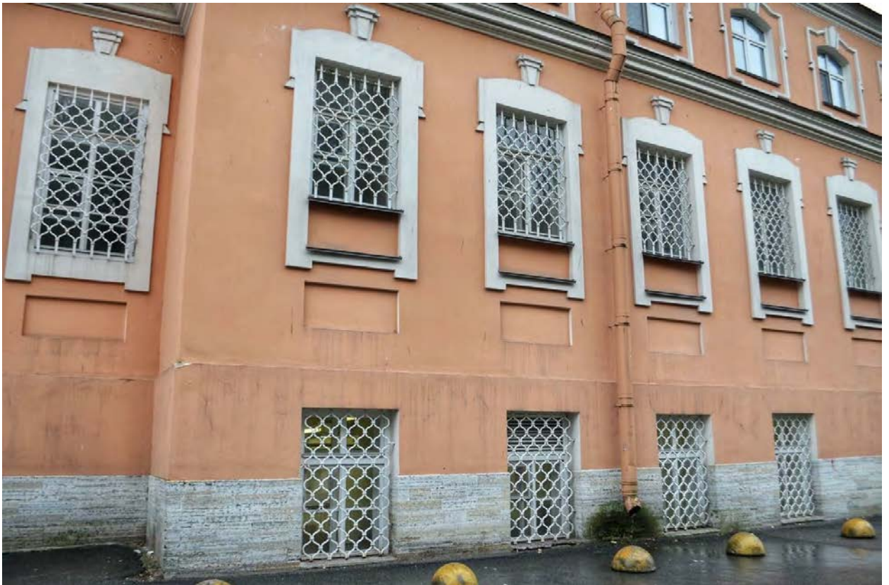
Фото 22. ОКН федерального значения «Корпус просфорный с северными воротами главного двора» (наб. реки Монастырки, дом 1, литера Г). Северо-западный фасад. Фрагмент. Съёмка 28.10.2020 г.
