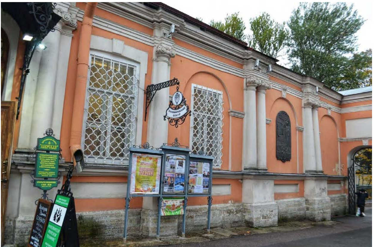
Фото 49. ОКН федерального значения «Корпус просфорный с северными воротами главного двора» (наб. реки Монастырки, дом 1, литера Г). Юго-восточный фасад. Фрагмент. Съёмка 28.10.2020 г.
