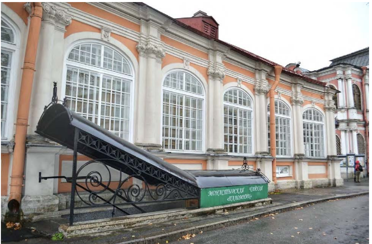
Фото 46. ОКН федерального значения «Корпус просфорный с северными воротами главного двора» (наб. реки Монастырки, дом 1, литера Г). Юго-восточный фасад. Фрагмент. Съёмка 28.10.2020 г.
