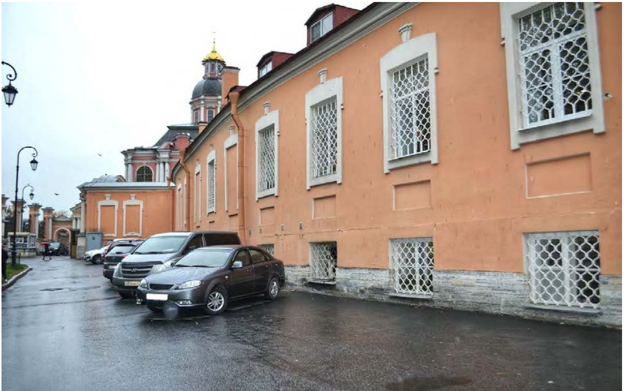
Фото 08. ОКН федерального значения «Корпус просфорный с северными воротами главного двора» (наб. реки Монастырки, дом 1, литера Г). Северо-западный фасад. Фрагмент. Съёмка 28.10.2020 г.
