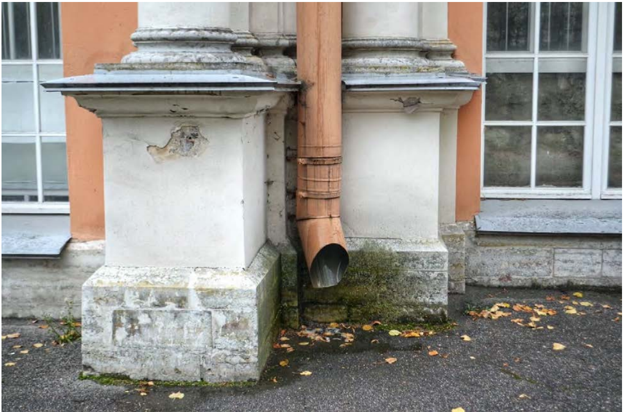
Фото 41. ОКН федерального значения «Корпус просфорный с северными воротами главного двора» (наб. реки Монастырки, дом 1, литера Г). Юго-восточный фасад. Фрагмент. Съёмка 28.10.2020 г.
