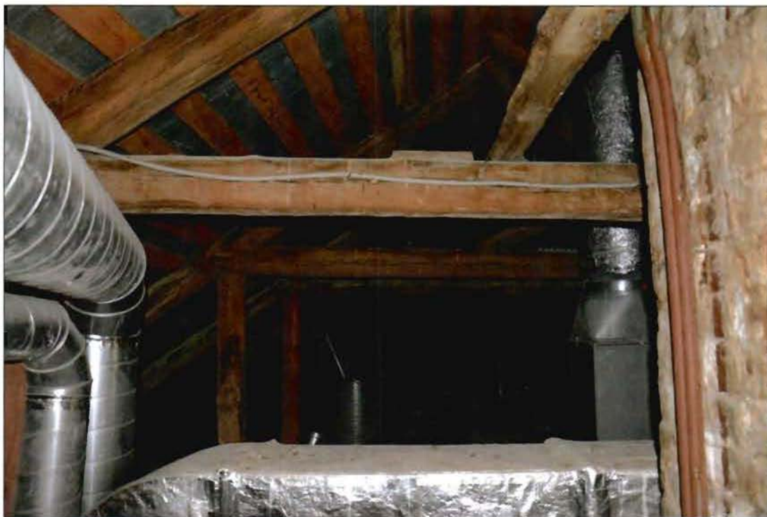
5. Стропильная система.
