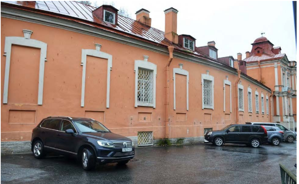
Фото 07. ОКН федерального значения «Корпус просфорный с северными воротами главного двора» (наб. реки Монастырки, дом 1, литера Г). Северо-западный фасад. Фрагмент. Съёмка 28.10.2020 г.
