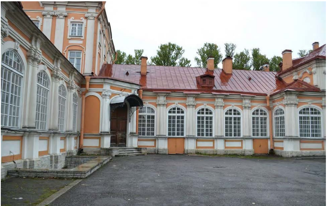
Фото 29. ОКН федерального значения «Корпус просфорный с северными воротами главного двора» (наб. реки Монастырки, дом 1, литера Г). Юго-восточный фасад. Фрагмент. Съёмка 28.10.2020 г.
