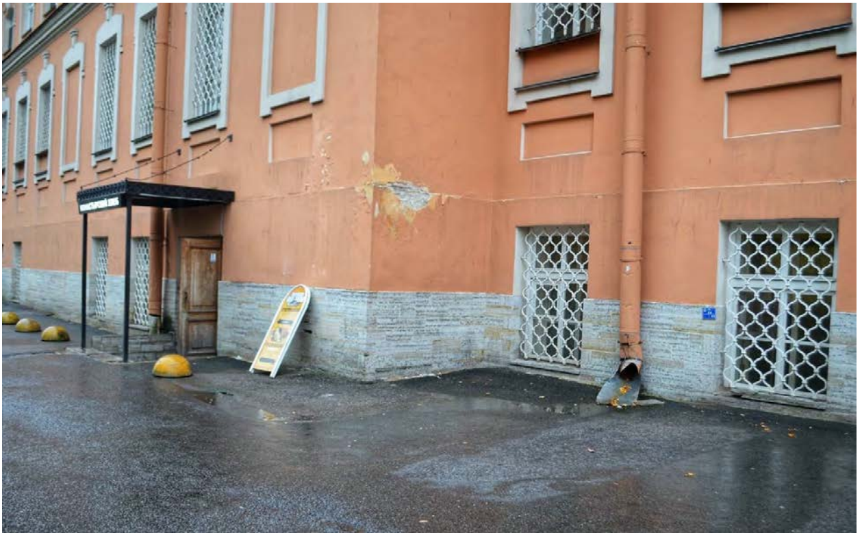
Фото 24. ОКН федерального значения «Корпус просфорный с северными воротами главного двора» (наб. реки Монастырки, дом 1, литера Г). Северо-западный фасад. Фрагмент. Съёмка 28.10.2020 г.
