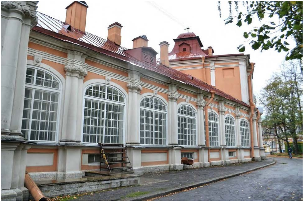
Фото 35. ОКН федерального значения «Корпус просфорный с северными воротами главного двора» (наб. реки Монастырки, дом 1, литера Г). Юго-восточный фасад. Фрагмент. Съёмка 28.10.2020 г.
