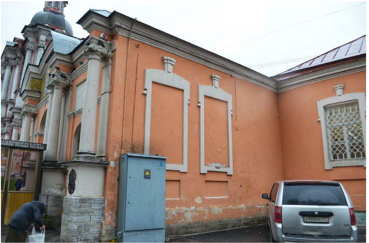
Фото 06. ОКН федерального значения «Корпус просфорный с северными воротами главного двора» (наб. реки Монастырки, дом 1, литера Г). Северо-западный фасад. Фрагмент. Съёмка 28.10.2020 г.
