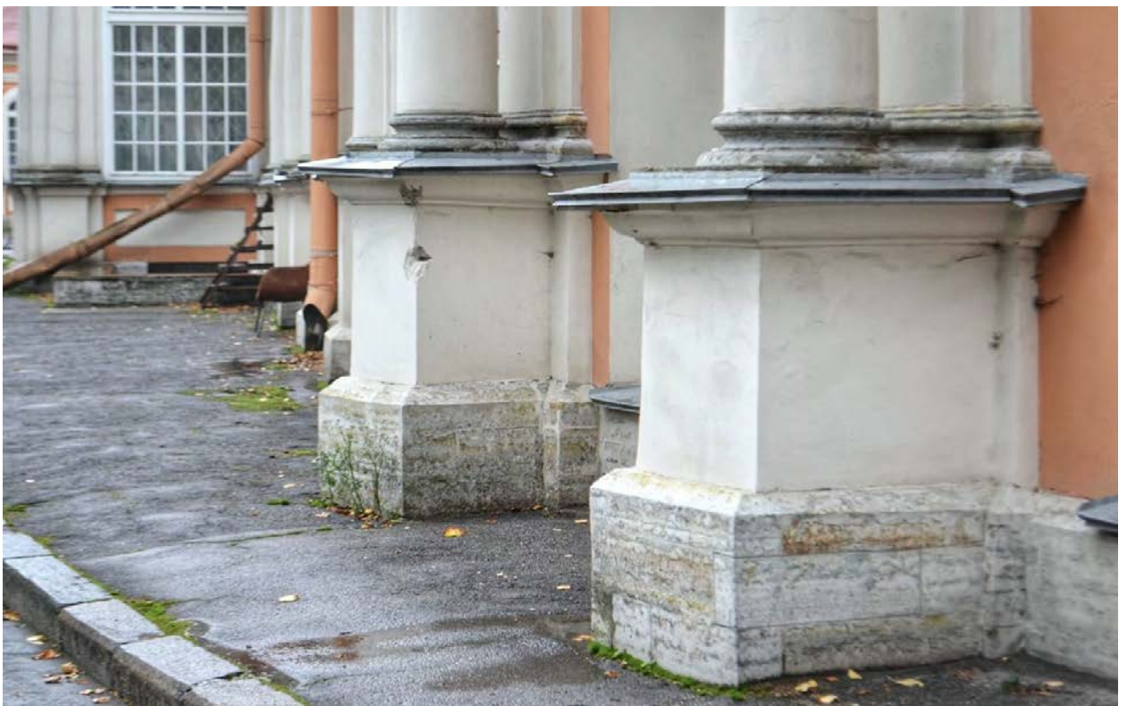
Фото 40. ОКН федерального значения «Корпус просфорный с северными воротами главного двора» (наб. реки Монастырки, дом 1, литера Г). Юго-восточный фасад. Фрагмент. Съёмка 28.10.2020 г.
