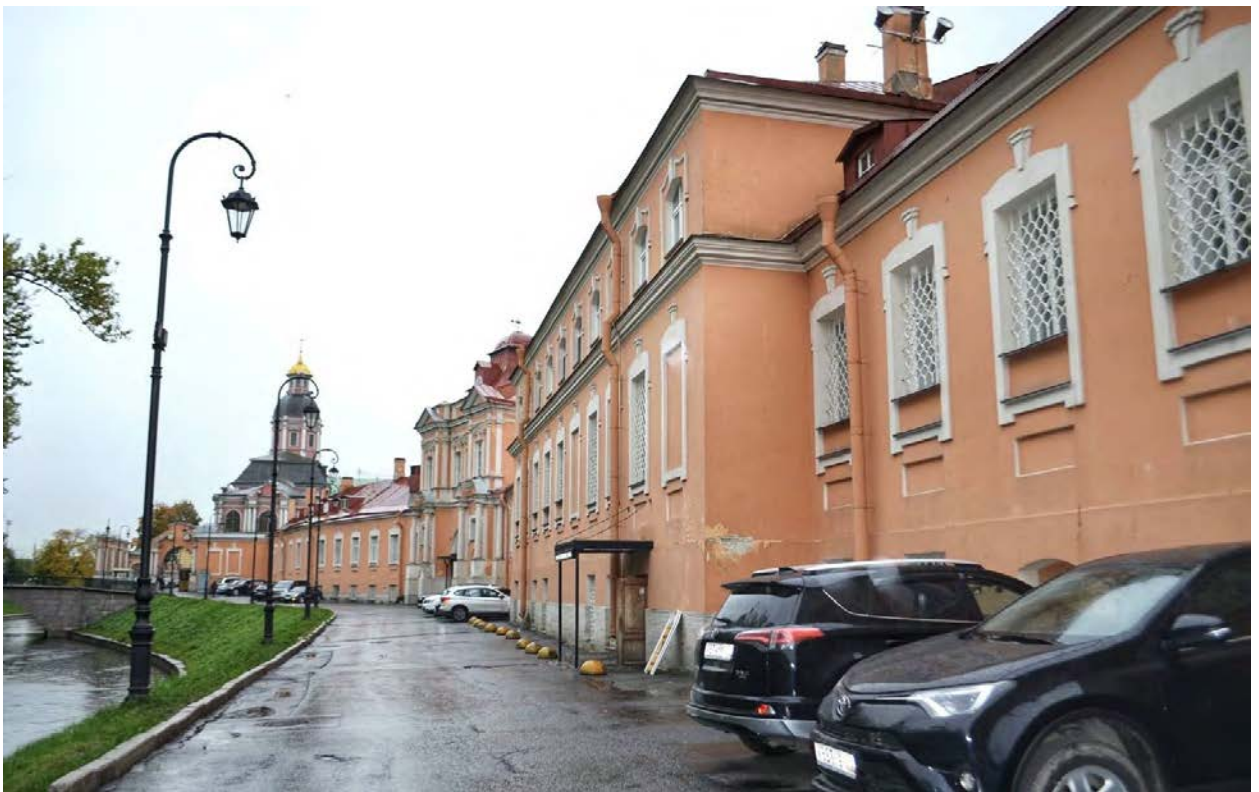
Фото 01. ОКН федерального значения «Корпус просфорный с северными воротами главного двора» (наб. реки Монастырки, дом 1, литера Г). Северо-западный фасад. Общий вид. Съёмка 28.10.2020 г.
