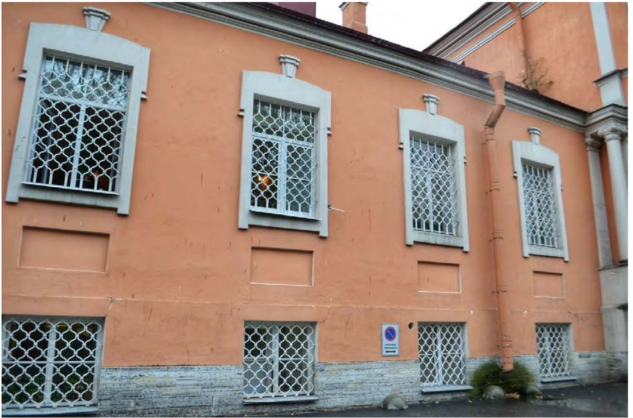
Фото 10. ОКН федерального значения «Корпус просфорный с северными воротами главного двора» (наб. реки Монастырки, дом 1, литера Г). Северо-западный фасад. Оконные проёмы в уровне первого и цокольного этажей. Фрагмент. Съёмка 28.10.2020 г.
