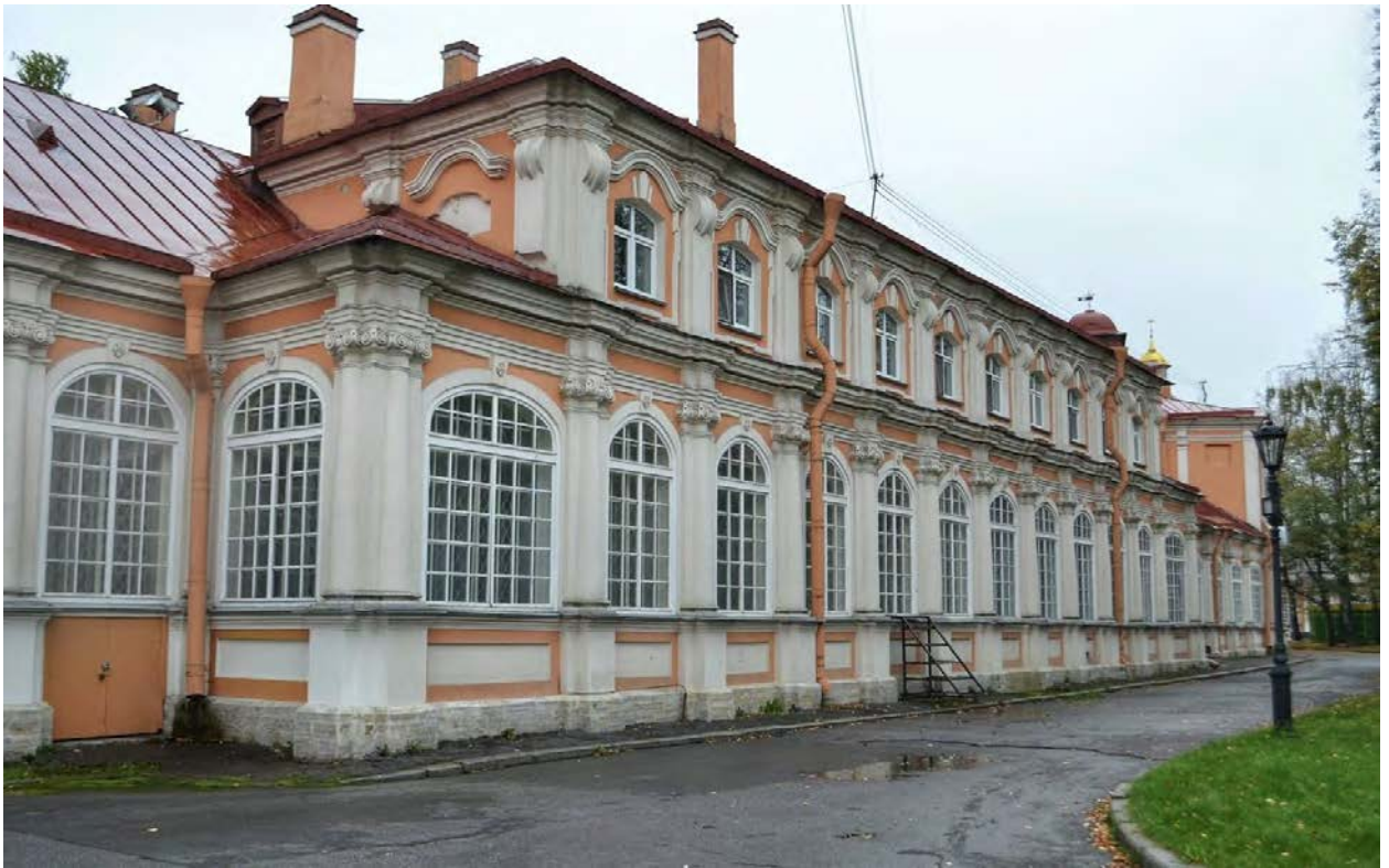
Фото 31. ОКН федерального значения «Корпус просфорный с северными воротами главного двора» (наб. реки Монастырки, дом 1, литера Г). Юго-восточный фасад. Фрагмент. Съёмка 28.10.2020 г.
