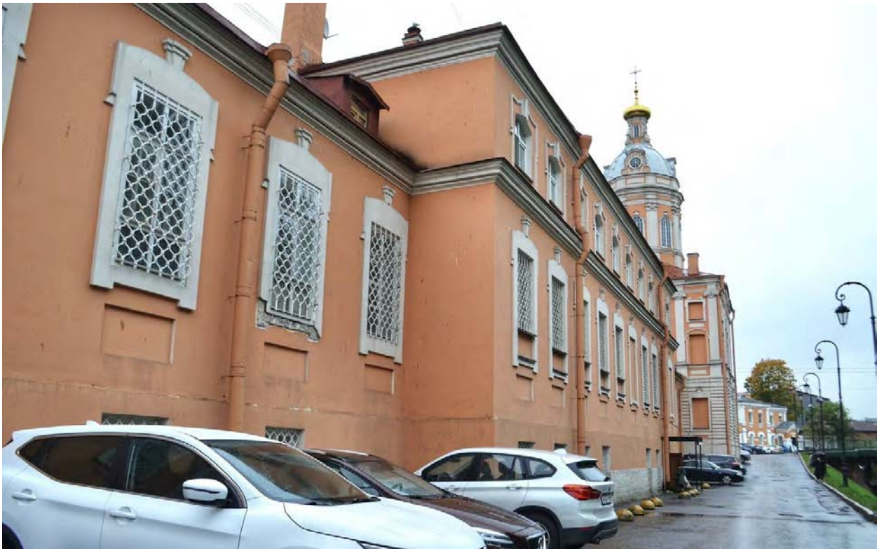
Фото 18. ОКН федерального значения «Корпус просфорный с северными воротами главного двора» (наб. реки Монастырки, дом 1, литера Г). Северо-западный фасад. Фрагмент. Съёмка 28.10.2020 г.
