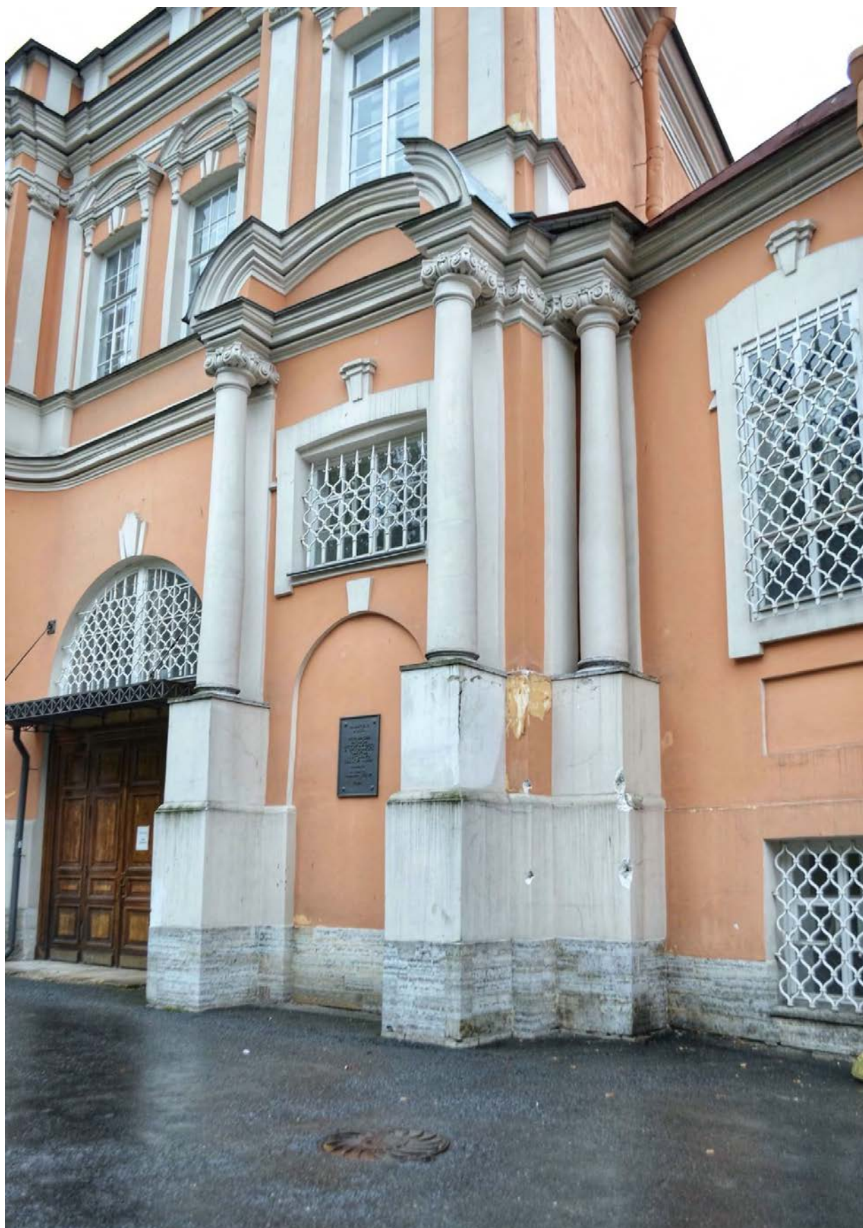
Фото 17. ОКН федерального значения «Корпус просфорный с северными воротами главного двора» (наб. реки Монастырки, дом 1, литера Г). Северо-западный фасад. Фрагмент. Съёмка 28.10.2020 г.
