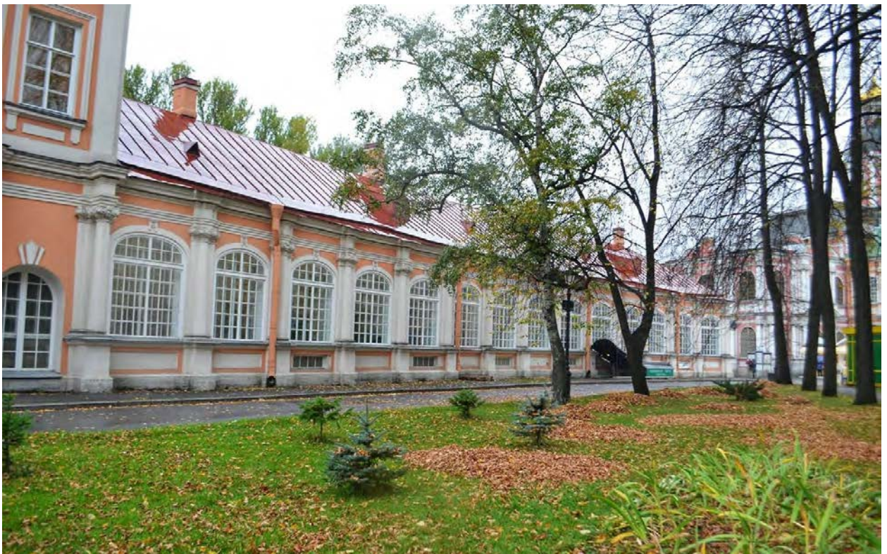
Фото 42. ОКН федерального значения «Корпус просфорный с северными воротами главного двора» (наб. реки Монастырки, дом 1, литера Г). Юго-восточный фасад. Фрагмент. Съёмка 28.10.2020 г.
