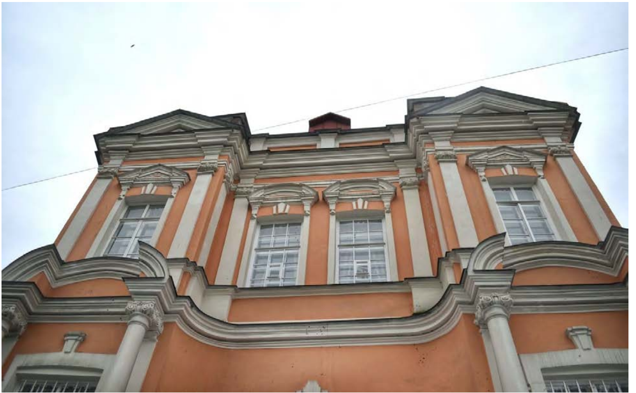
Фото 13. ОКН федерального значения «Корпус просфорный с северными воротами главного двора» (наб. реки Монастырки, дом 1, литера Г). Северо-западный фасад. Фрагмент. Съёмка 28.10.2020 г.
