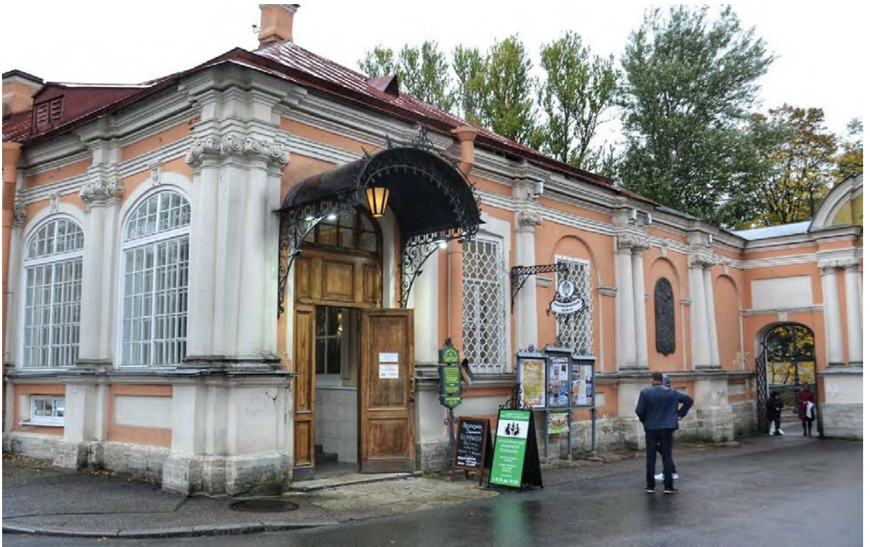
Фото 48. ОКН федерального значения «Корпус просфорный с северными воротами главного двора» (наб. реки Монастырки, дом 1, литера Г). Юго-восточный фасад. Фрагмент. Съёмка 28.10.2020 г.
