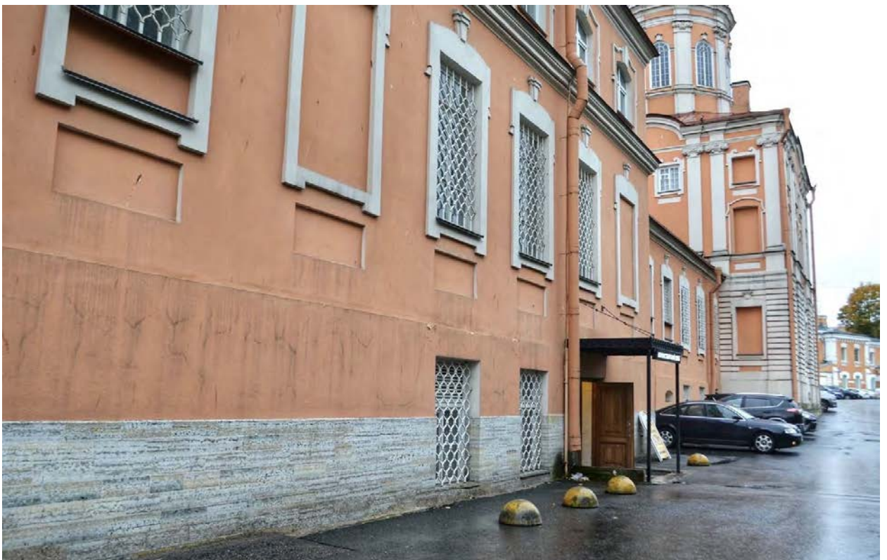
Фото 23. ОКН федерального значения «Корпус просфорный с северными воротами главного двора» (наб. реки Монастырки, дом 1, литера Г). Северо-западный фасад. Фрагмент. Съёмка 28.10.2020 г.
