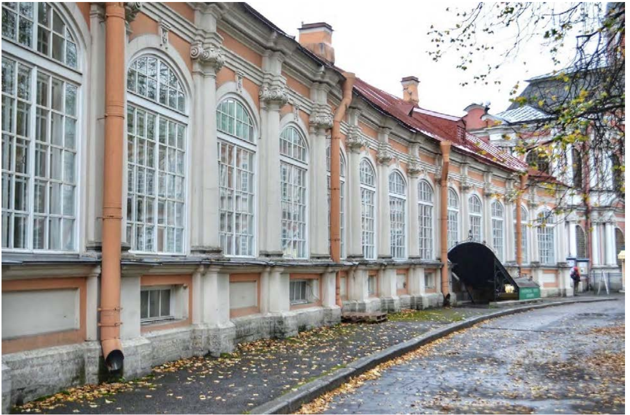
Фото 43. ОКН федерального значения «Корпус просфорный с северными воротами главного двора» (наб. реки Монастырки, дом 1, литера Г). Юго-восточный фасад. Фрагмент. Съёмка 28.10.2020 г.
