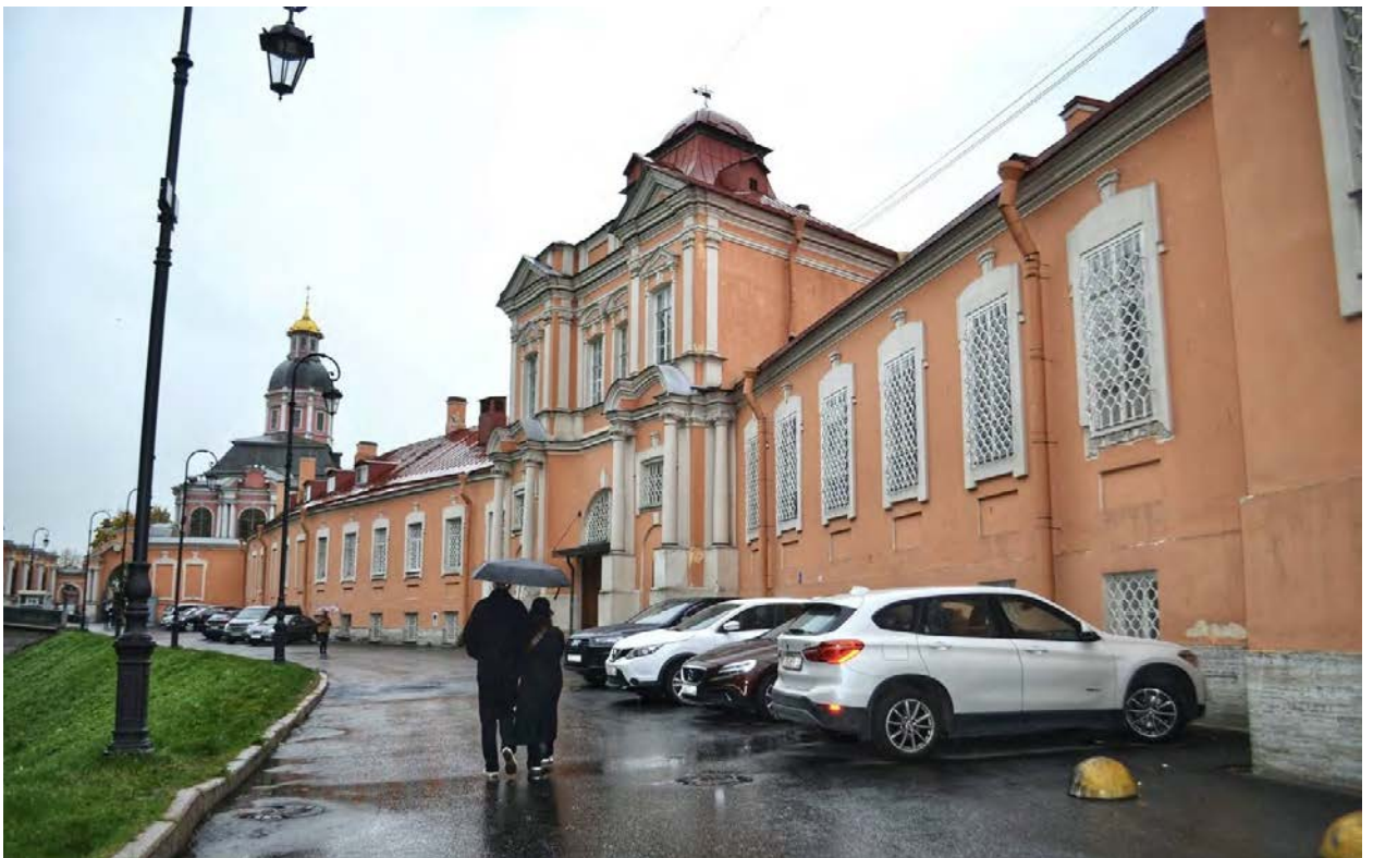
Фото 19. ОКН федерального значения «Корпус просфорный с северными воротами главного двора» (наб. реки Монастырки, дом 1, литера Г). Северо-западный фасад. Фрагмент. Съёмка 28.10.2020 г.
