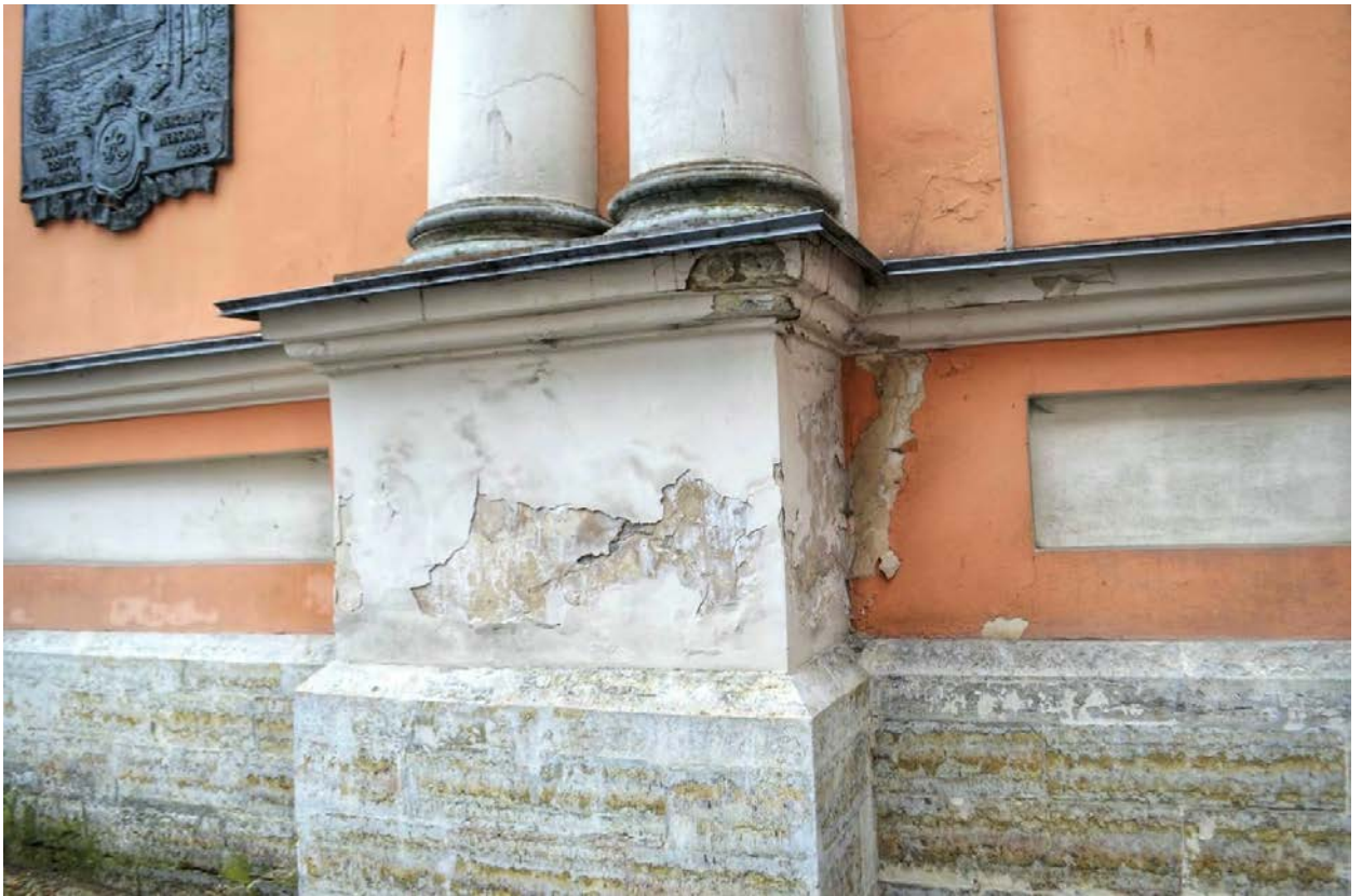
Фото 51. ОКН федерального значения «Корпус просфорный с северными воротами главного двора» (наб. реки Монастырки, дом 1, литера Г). Юго-восточный фасад. Фрагмент. Съёмка 28.10.2020 г.
