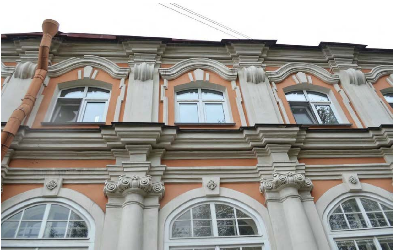
Фото 33. ОКН федерального значения «Корпус просфорный с северными воротами главного двора» (наб. реки Монастырки, дом 1, литера Г). Юго-восточный фасад. Оконные проёмы в уровне первого и второго этажа. Фрагмент. Съёмка 28.10.2020 г.
