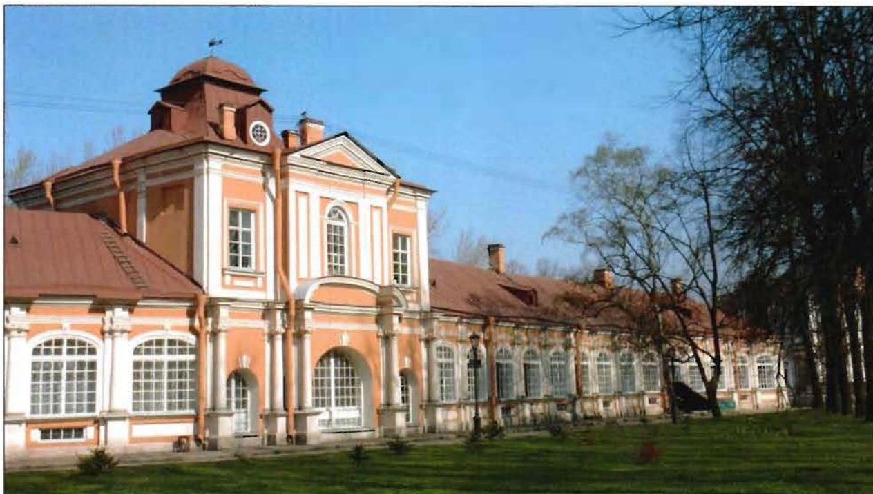
3. Южный фасад. Восточная часть.
