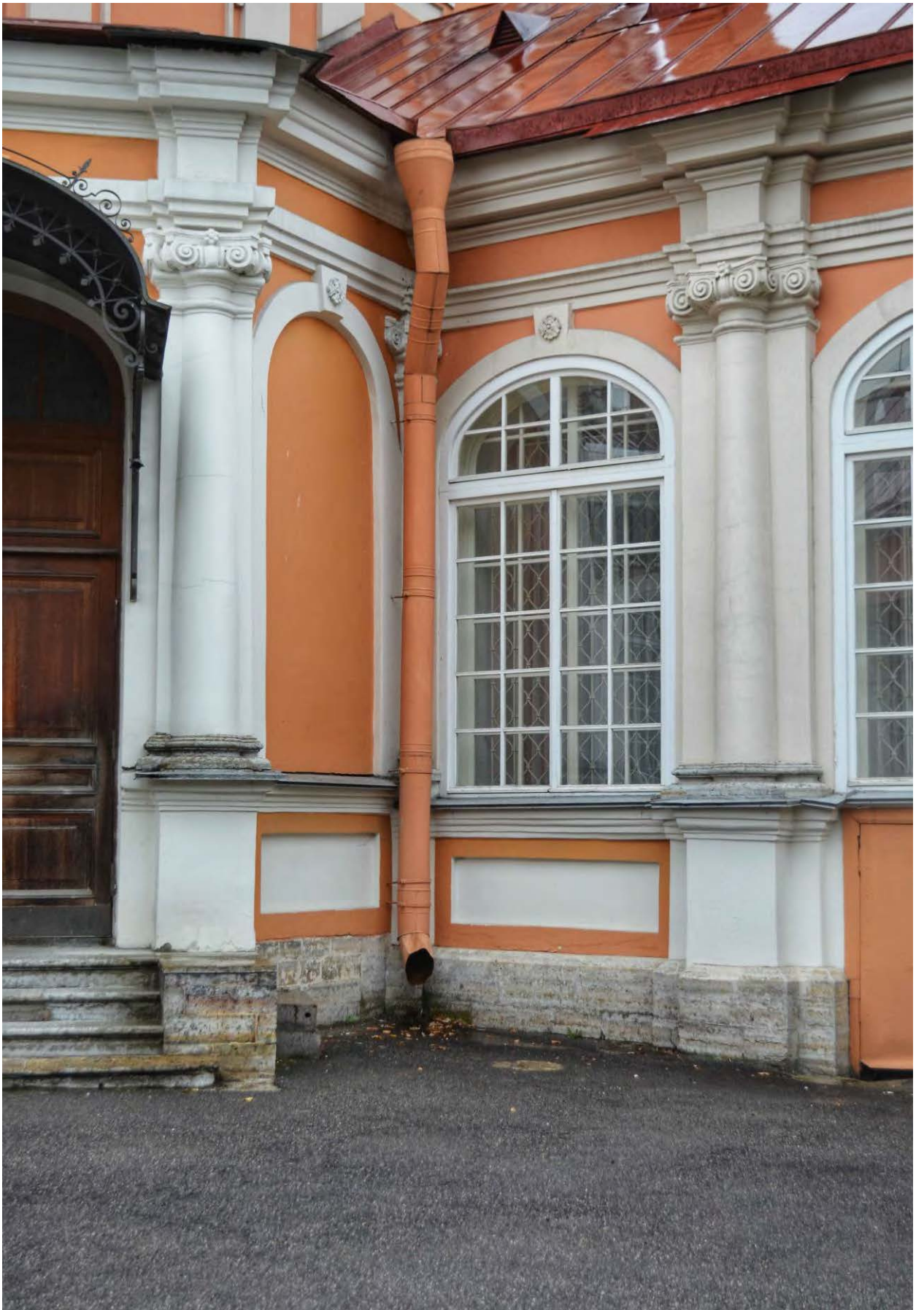
Фото 30. ОКН федерального значения «Корпус просфорный с северными воротами главного двора» (наб. реки Монастырки, дом 1, литера Г). Юго-восточный фасад. Фрагмент. Съёмка 28.10.2020 г.
