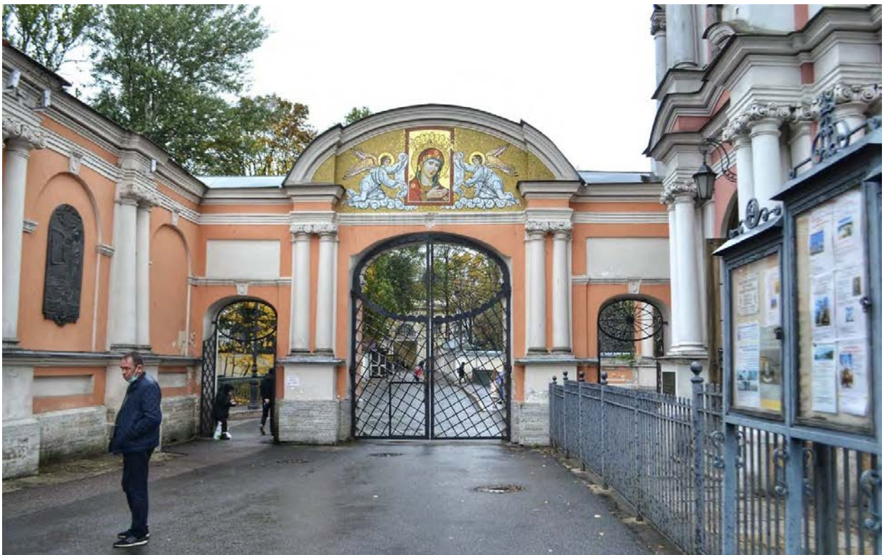
Фото 52. ОКН федерального значения «Корпус просфорный с северными воротами главного двора» (наб. реки Монастырки, дом 1, литера Г). Ворота. Общий вид. Съёмка 28.10.2020 г.
