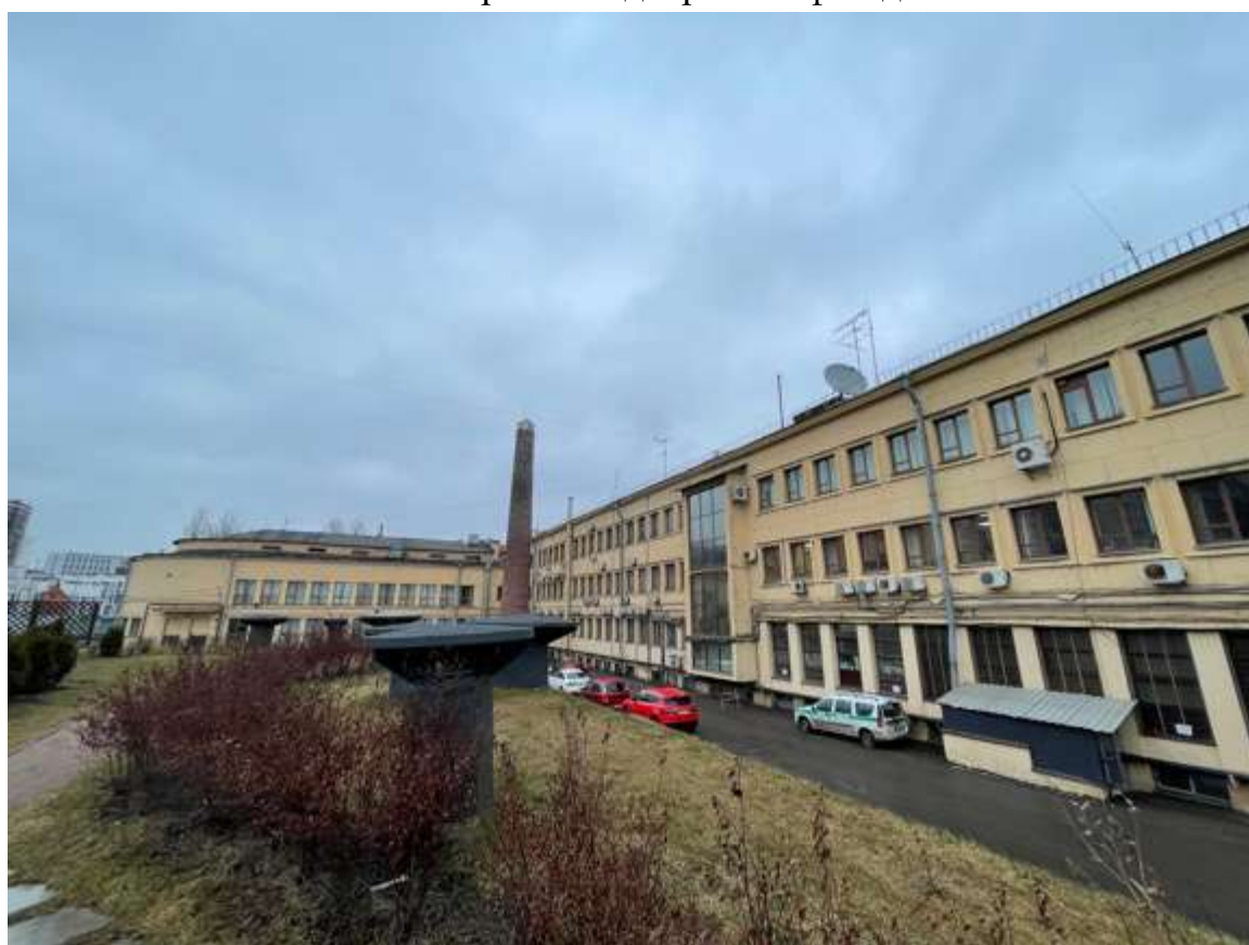
11. Фрагмент дворового фасада
