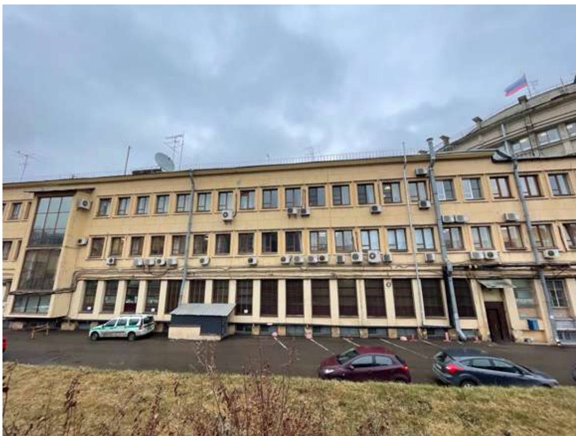
10. Фрагмент дворового фасада
