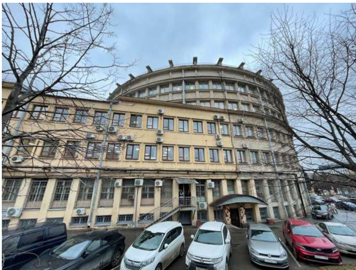
8. Фрагмент дворового фасада
