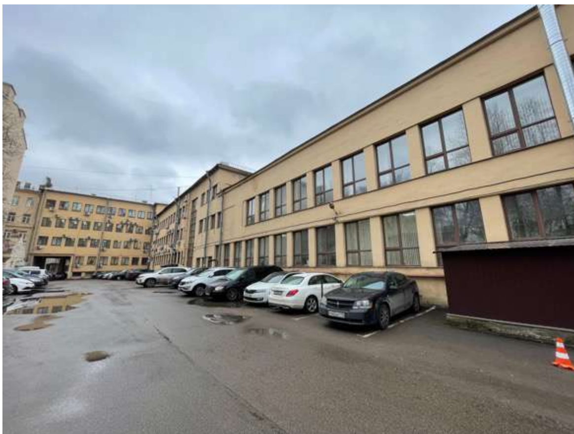
16. Фрагмент дворового фасада
