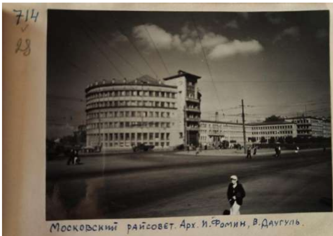
98. Шиманский С.Г. Здание Московского райсовета, г. Ленинград. Общий вид. Из альбома контрольных отпечатков С. Г. Шиманского «Ленинград советский, №1». Архитектор: Даугуль В.Г.; Архитектор: Фомин И.И.; Архитектор: Серебровский Б.М. 1947-1948 г. Федеральное государственное бюджетное учреждение культуры "Государственный научно-исследовательский музей архитектуры имени А.В. Щусева". Номер в Госкаталоге: 50099769. Номер по КП (ГИК): ГНИМА ОФ-4834/2649
