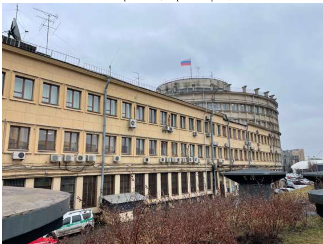
13. Фрагмент дворового фасада
