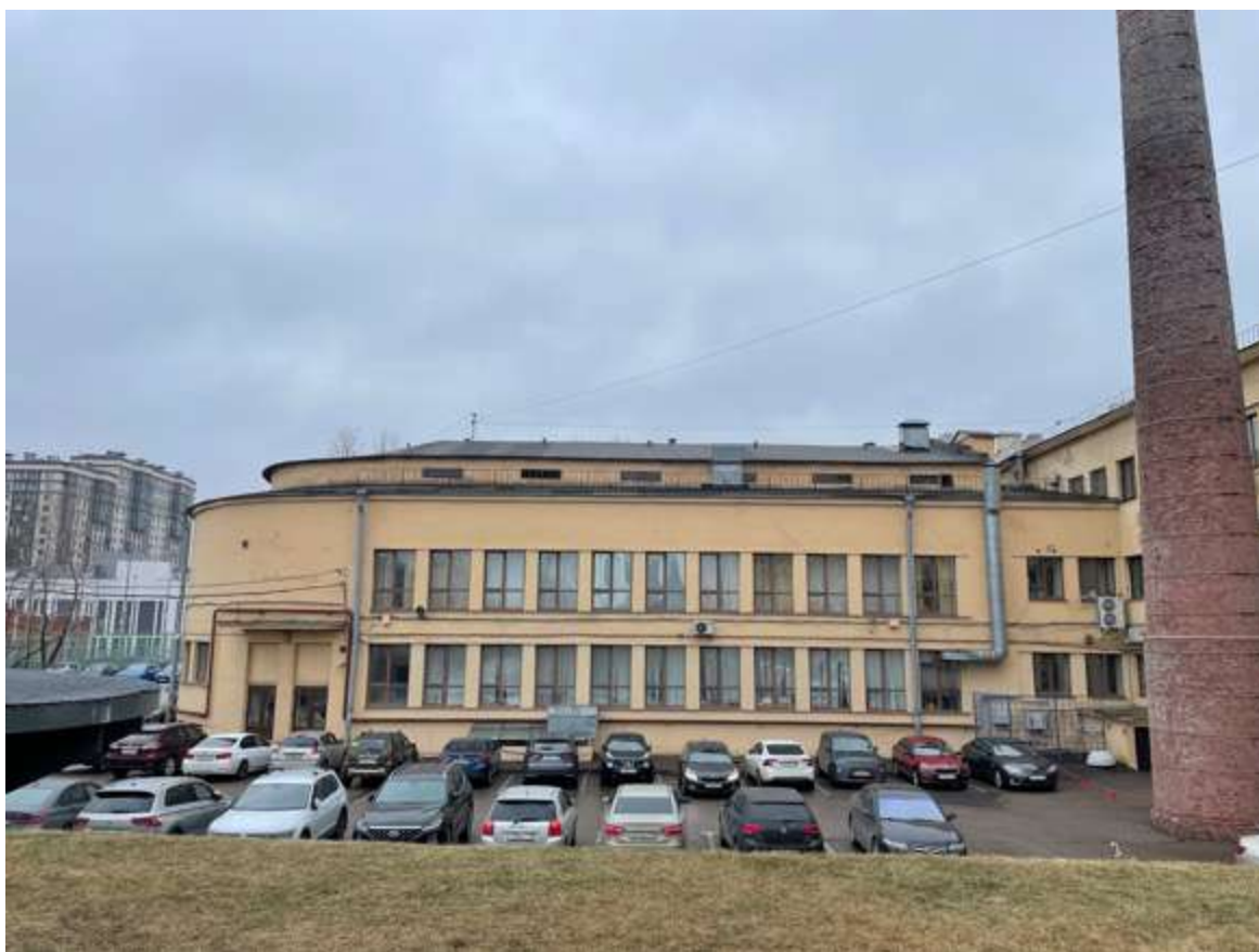
12. Фрагмент дворового фасада
