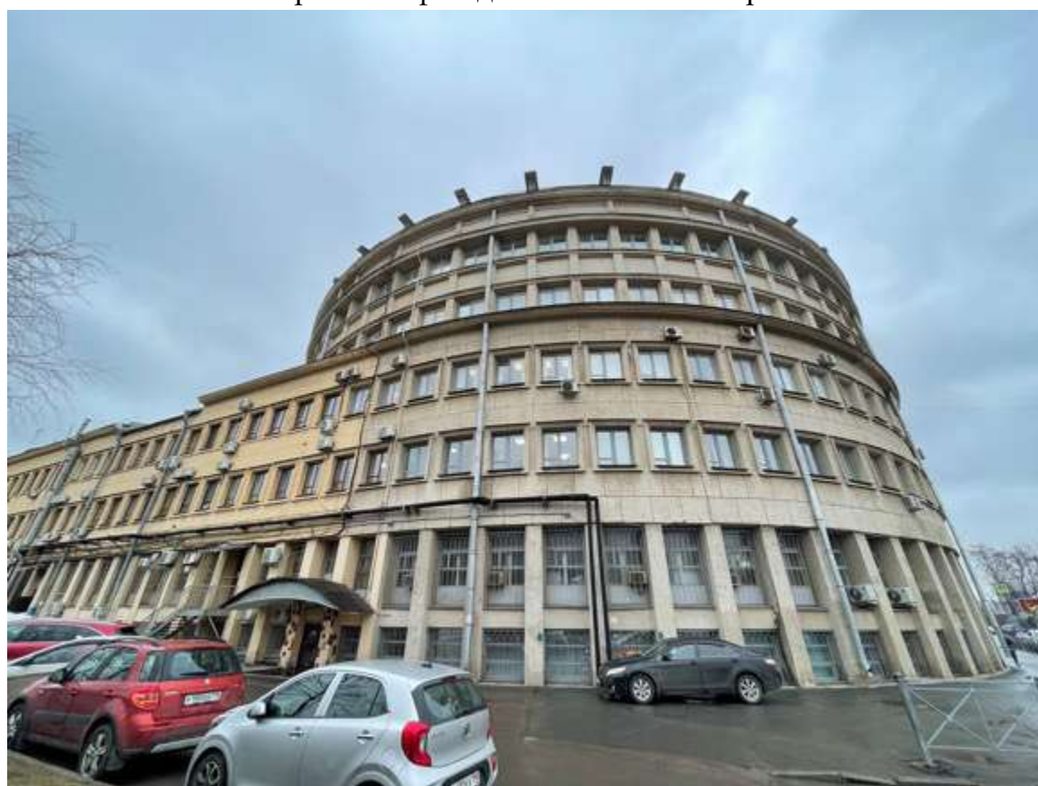
7. Фрагмент дворового фасада
