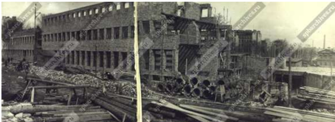
33. Строительство Дома Райсовета на Международном проспекте (Московский район). 1932 г. ЦГАКФФД СПб. Фотодокументы. Оп.1БР-2. Ед.хр.621
