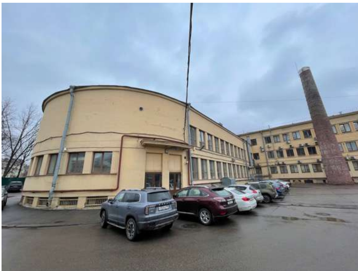
14. Фрагмент дворового фасада
