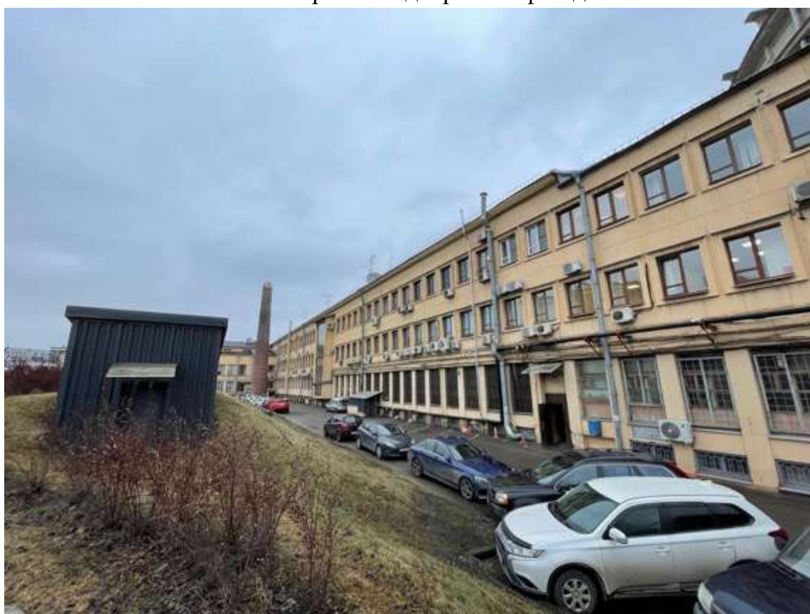
9. Фрагмент дворового фасада
