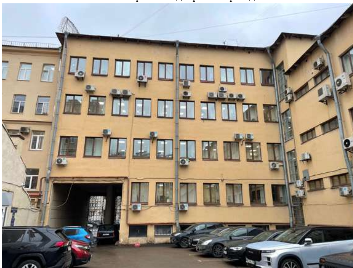
17. Фрагмент дворового фасада
