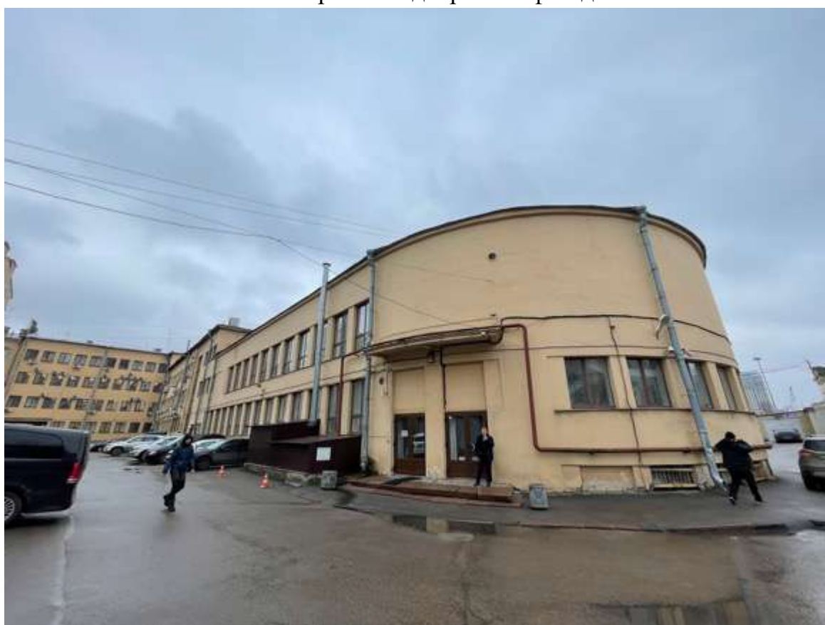
15. Фрагмент дворового фасада
