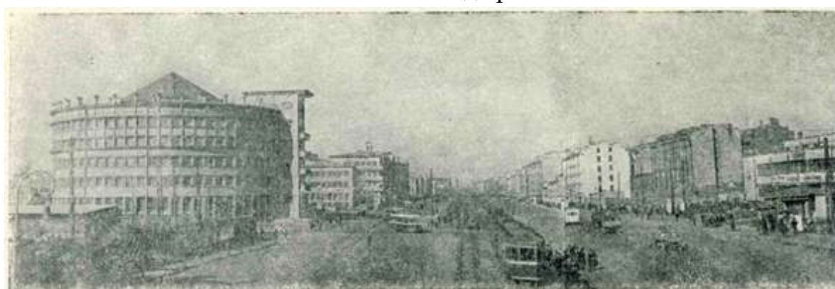
Московское шоссе. У здания Московского районного совета. Авторы: архитекторы И. И. Фомин и В. Г. Даугуль
