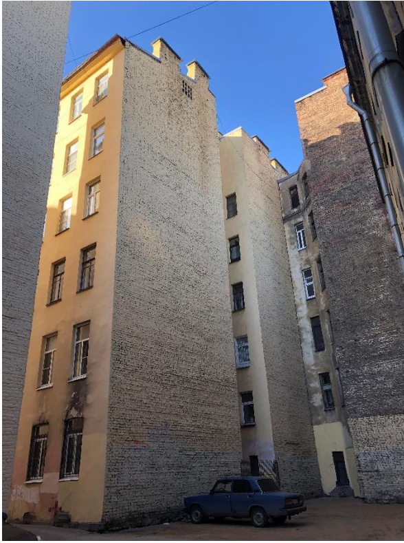
Фото 13. Вид на дворовой фасад.
