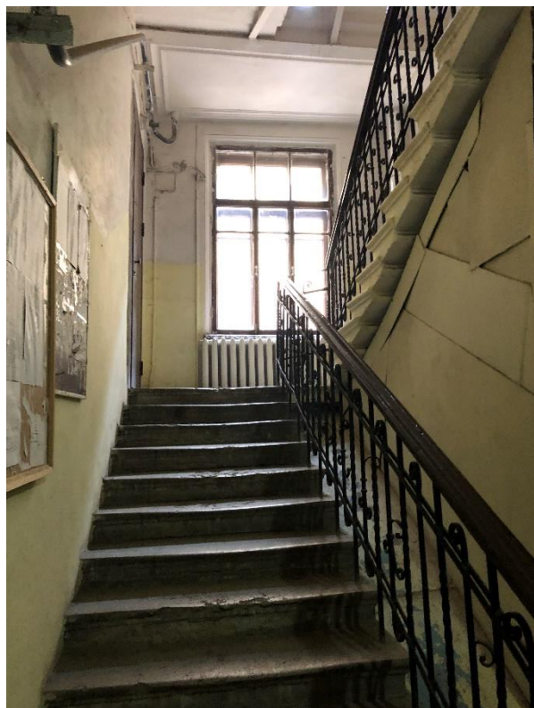
Фото 15. Вид помещения черной лестницы (Л 3).
