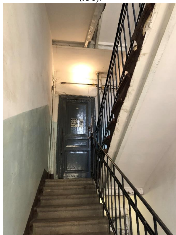
Фото 4. Вид помещения черной лестницы (Л 1).
