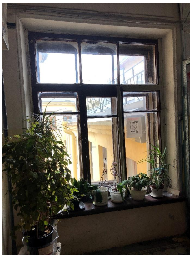
Фото 19. Вид помещения черной лестницы (Л 3).
