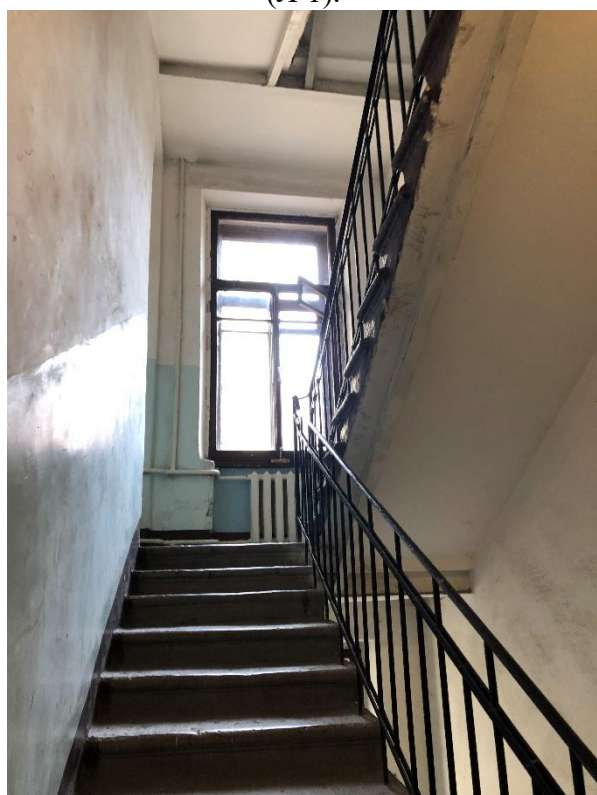
Фото 3. Вид помещения черной лестницы (Л 1).
