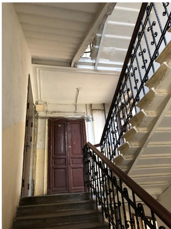
Фото 17. Вид помещения черной лестницы (Л 3).
