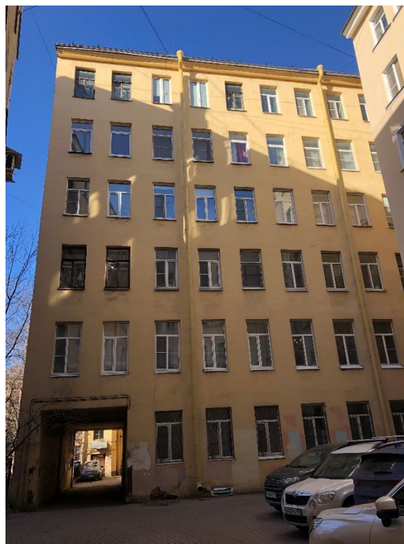
Фото 12. Вид на дворовой фасад.
