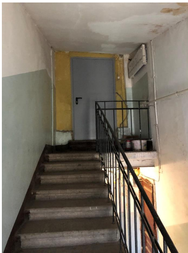
Фото 6. Вид помещения черной лестницы (Л 1).
