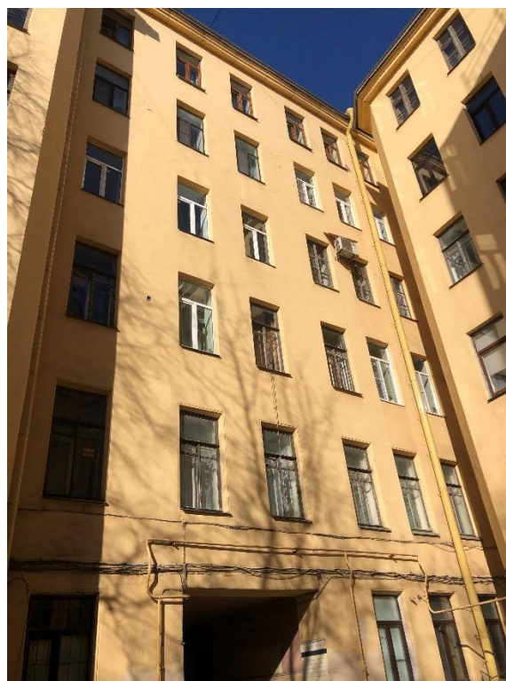
Фото 7. Вид на дворовой фасад.
