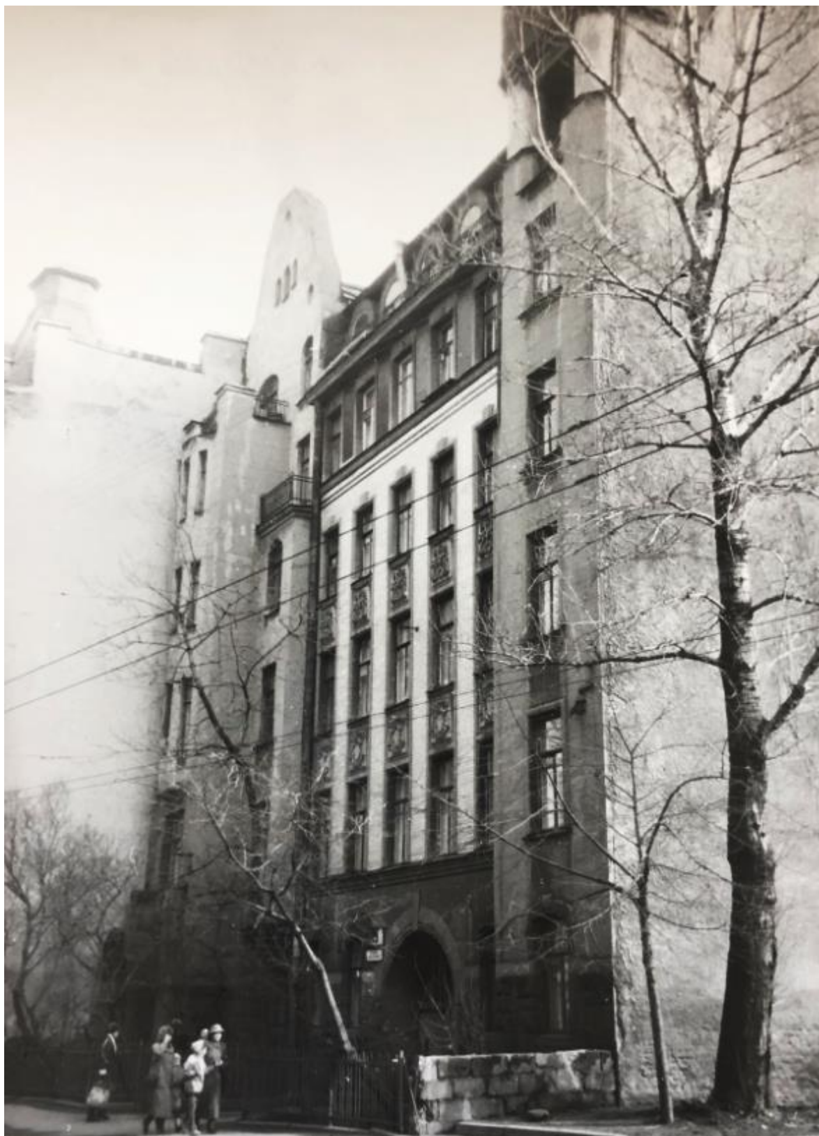
Илл. 57. Лицевой фасад. Дата: 1993 г. Автор: К.В. Овчинников. Источник: архив КГИОП.
