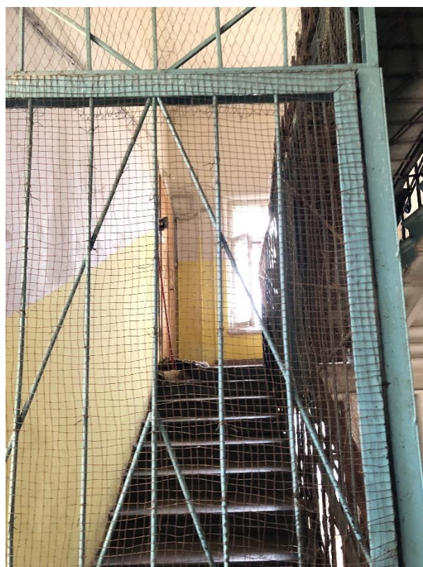
Фото 20. Вид помещения черной лестницы (Л 3).
