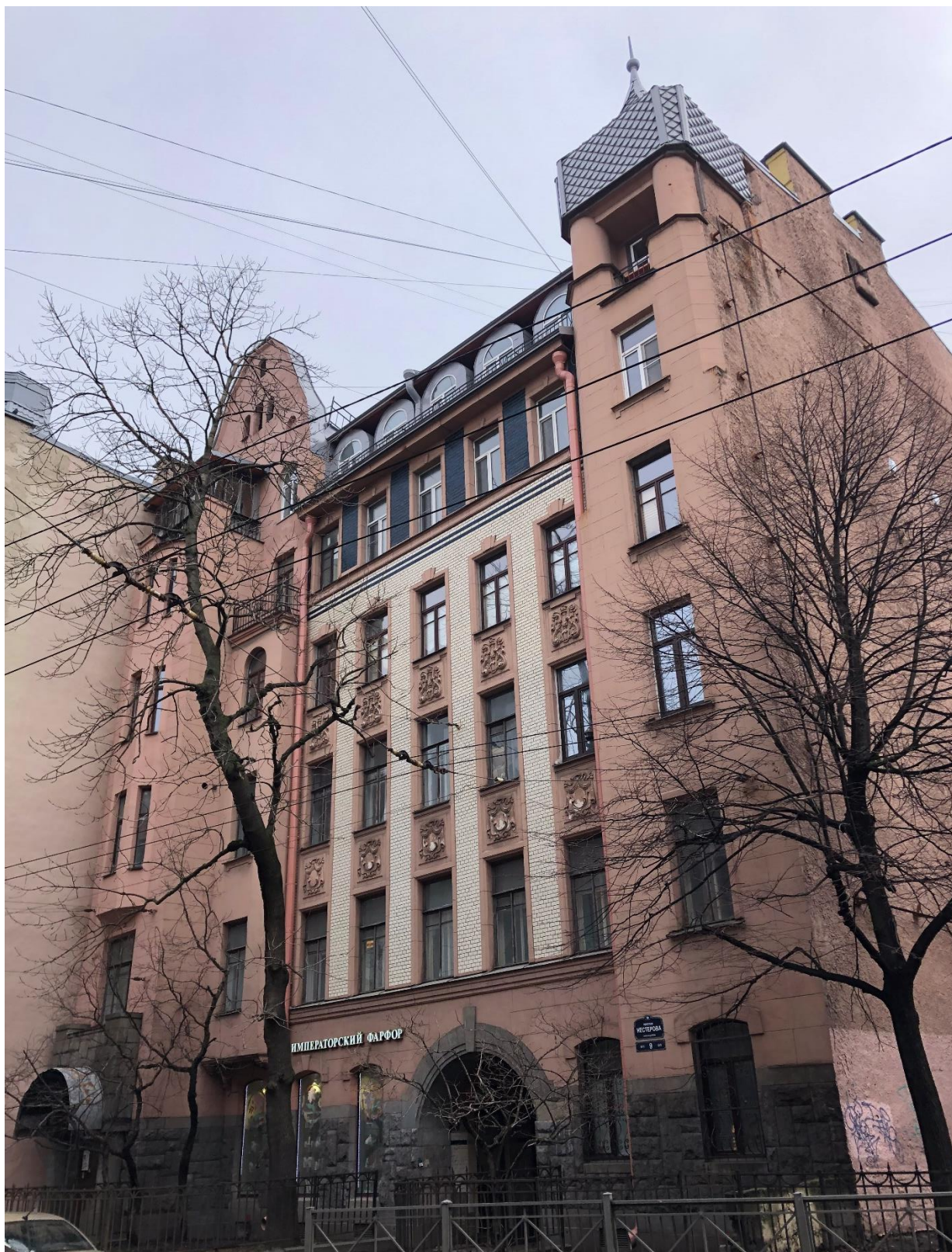
Фото 3. Вид на лицевой фасад дома № 9 по переулку Нестерова.
