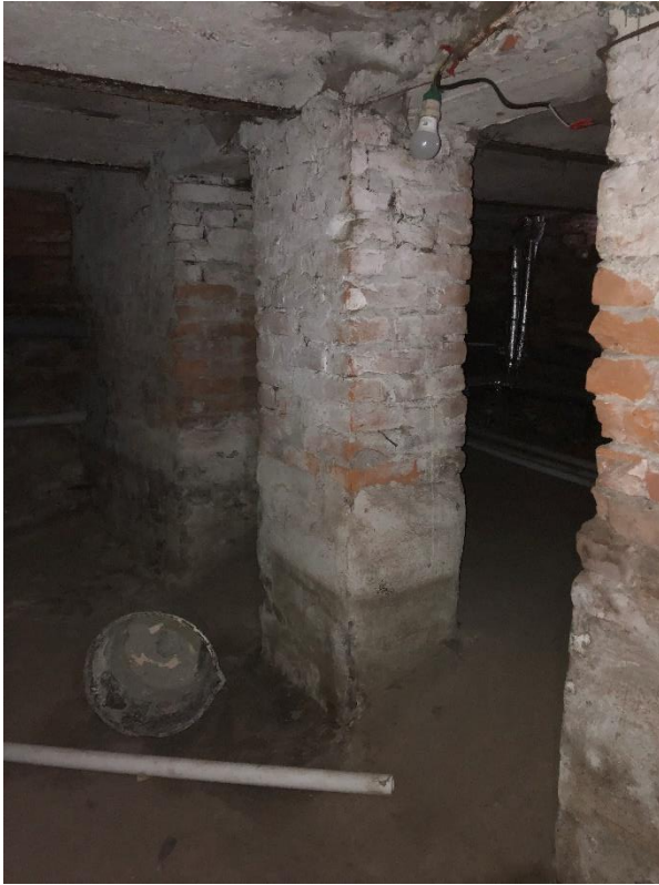
Фото 21. Вид на подвальные помещения.
