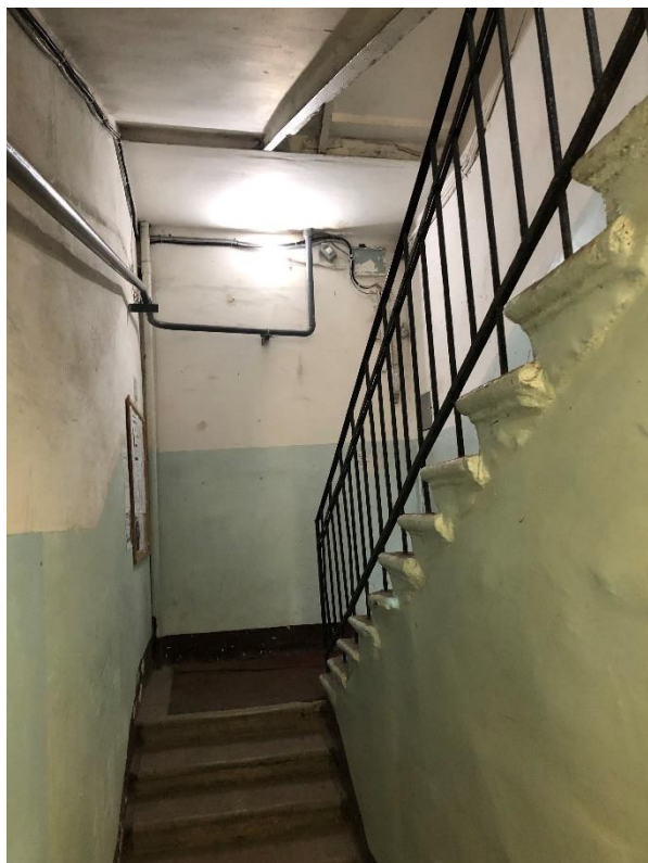
Фото 1. Вид помещения черной лестницы (Л 1).
