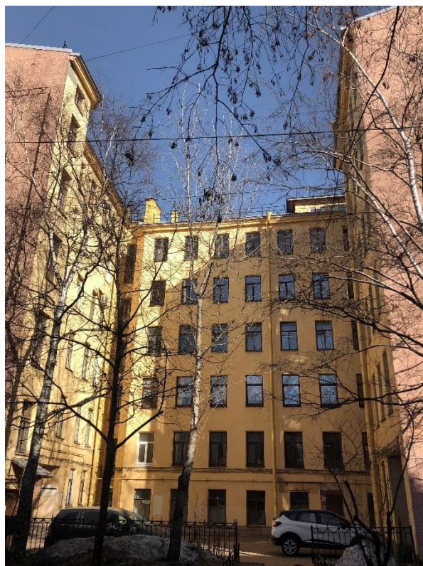
Фото 8. Вид на дворовой фасад.
