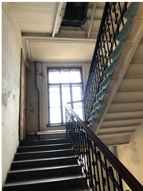
Фото 18. Вид помещения черной лестницы (Л 3).
