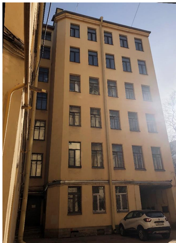
Фото 9. Вид на дворовой фасад.
