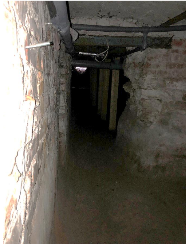
Фото 22. Вид на подвальные помещения.
