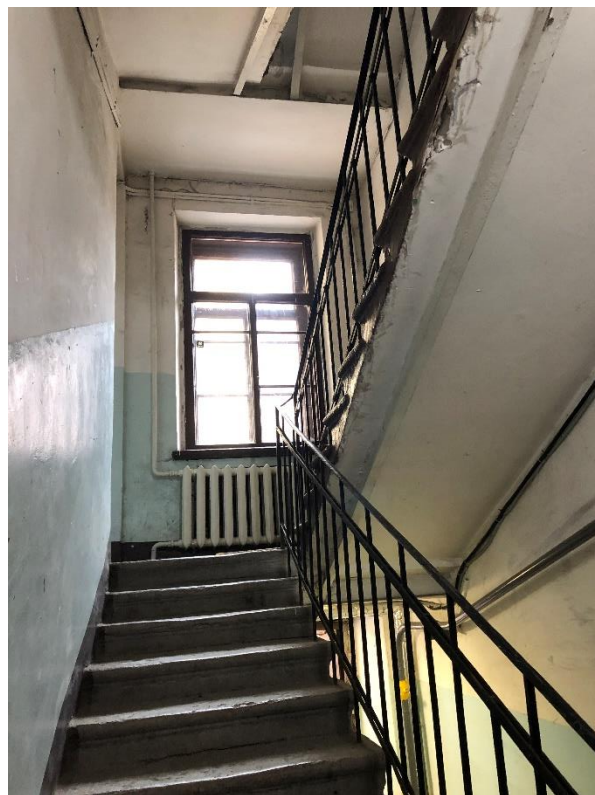
Фото 2. Вид помещения черной лестницы (Л 1).
