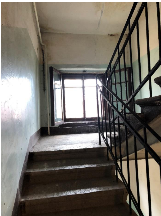
Фото 5. Вид помещения черной лестницы (Л 1).
