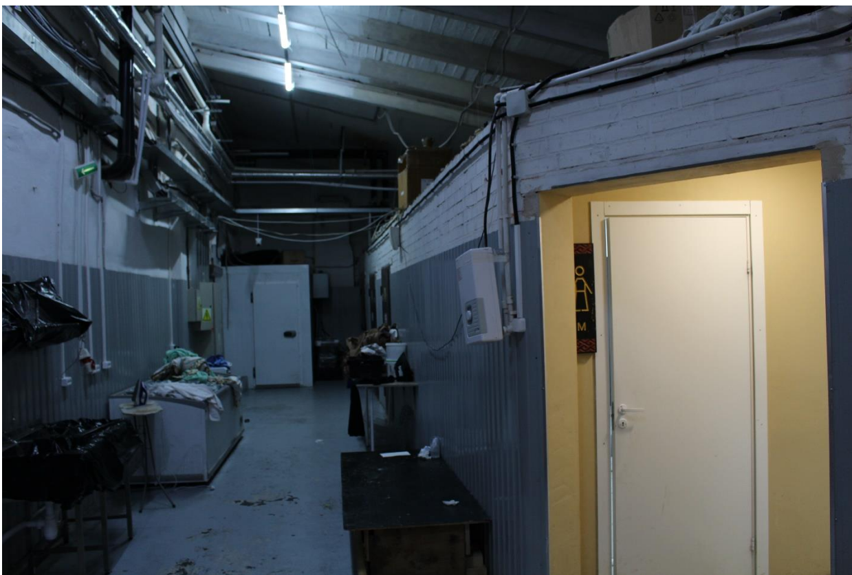
Фото 38. Интерьер внутренних помещений выявленного объекта культурного наследия «Производственный цех».
