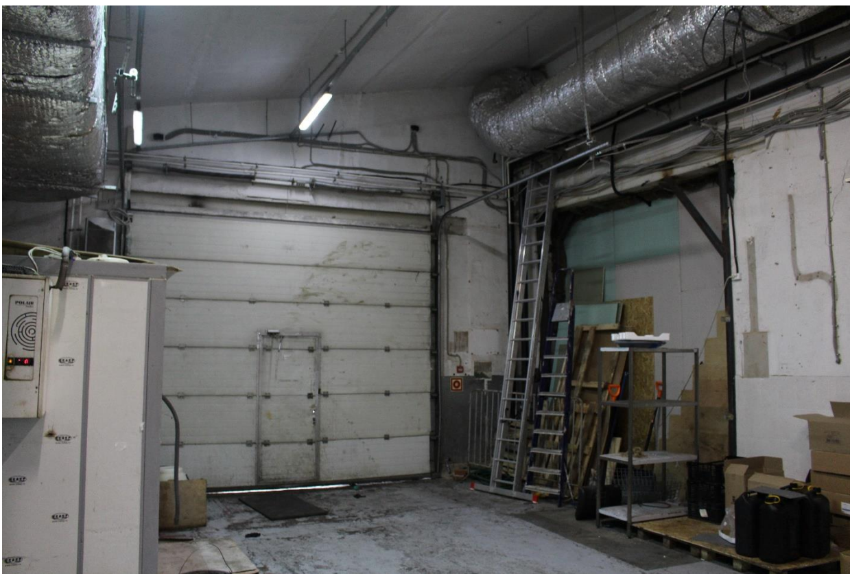
Фото 44. Интерьер внутренних помещений выявленного объекта культурного наследия «Производственный цех».
