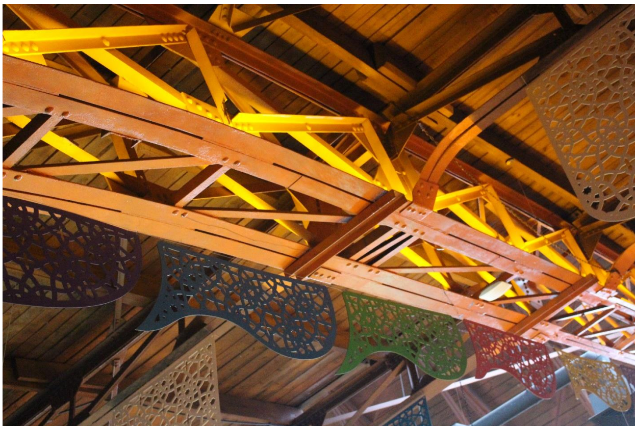
Фото 18. Интерьер внутренних помещений выявленного объекта культурного наследия «Производственный цех».
