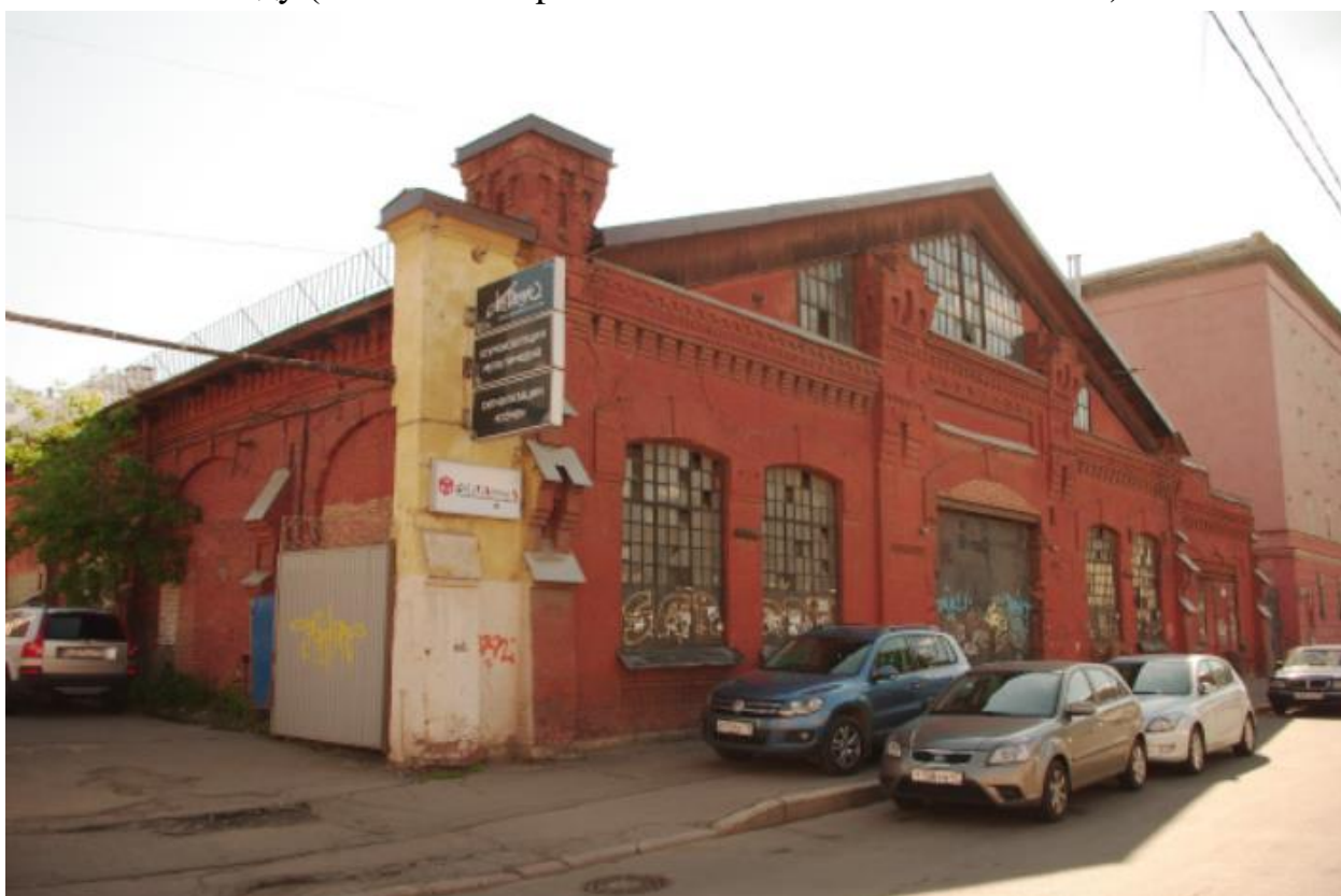
Илл. 118. Вид на здание по адресу: Санкт-Петербург, 16-я линия В.О., 83 в 2012 году (источник: https://kanoner.com/2012/06/04/49059/ ).
