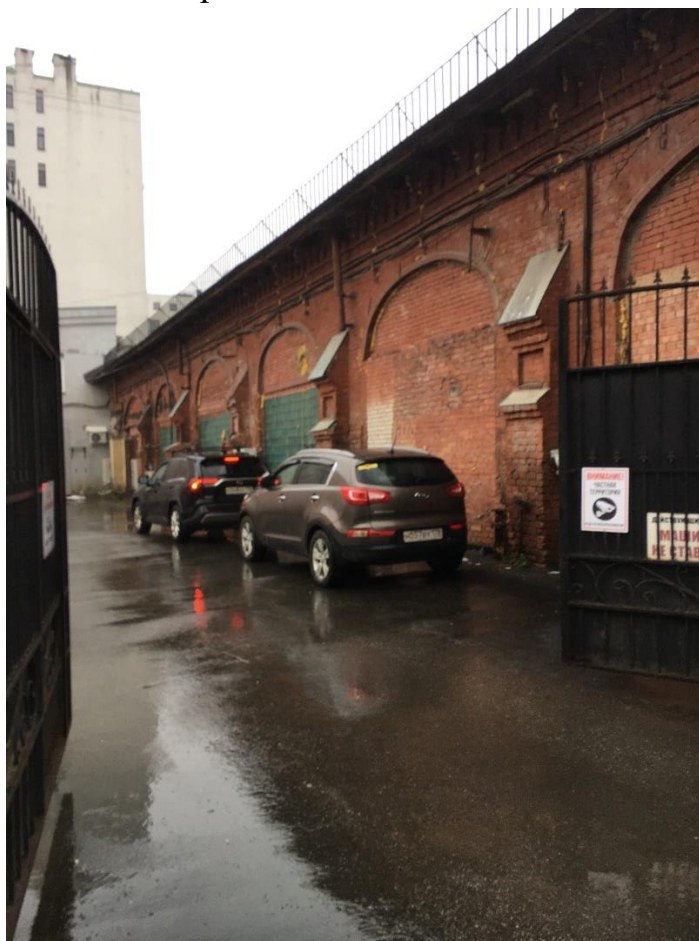
Фото 4. Вид на северо-западный фасад выявленного объекта культурного наследия «Производственный цех».
