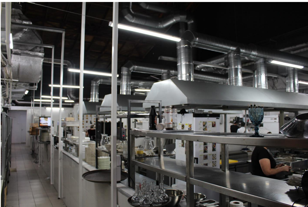
Фото 34. Интерьер внутренних помещений выявленного объекта культурного наследия «Производственный цех».
