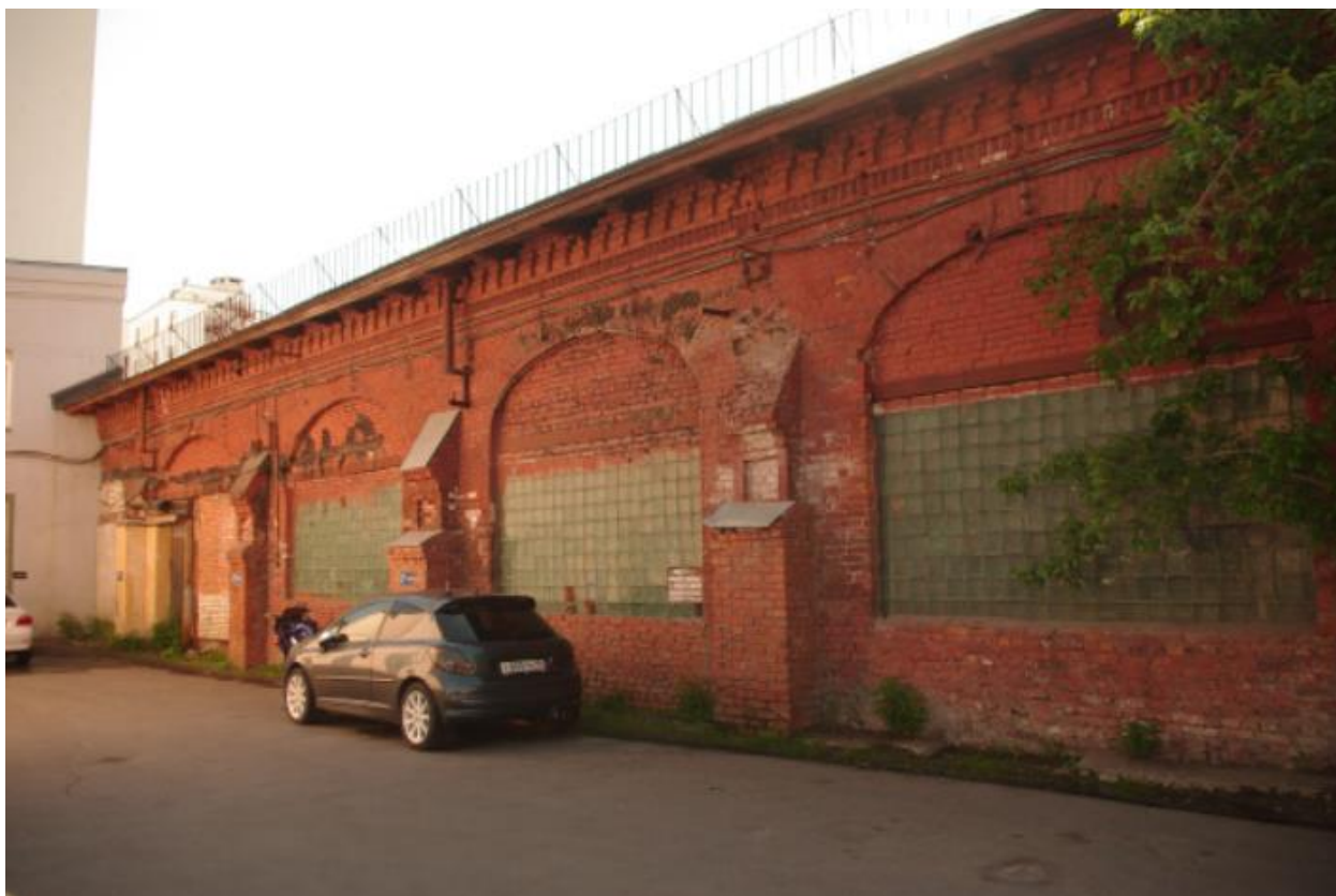
Илл. 119. Вид на северо-западный фасад здания по адресу: Санкт-Петербург, 16-я линия В.О., 83 в 2012 году (источник: https://kanoner.com/2012/06/04/49059/ ).
