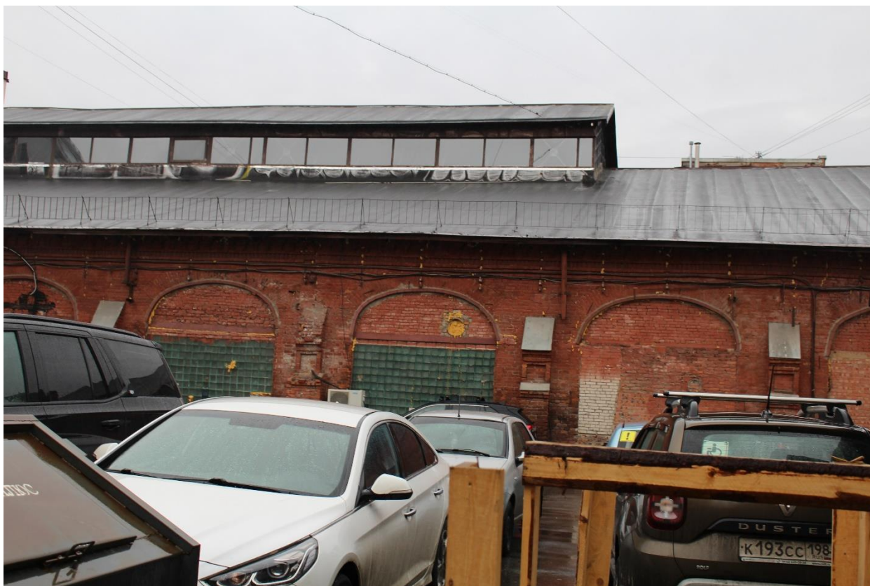
Фото 5. Вид на северо-западный фасад выявленного объекта культурного наследия «Производственный цех».
