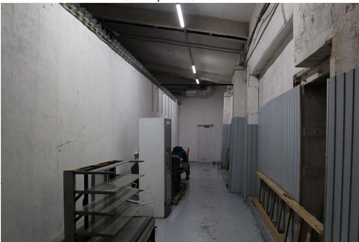
Фото 43. Интерьер внутренних помещений выявленного объекта культурного наследия «Производственный цех».
