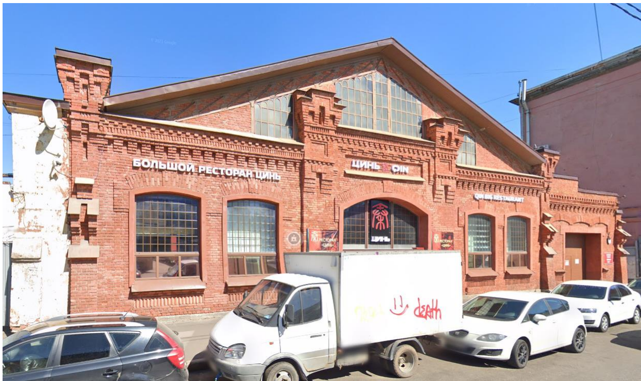
Илл.127. Вид на здание по адресу: Санкт-Петербург, 16-я линия В.О., 83 в 2021 году (источник:
