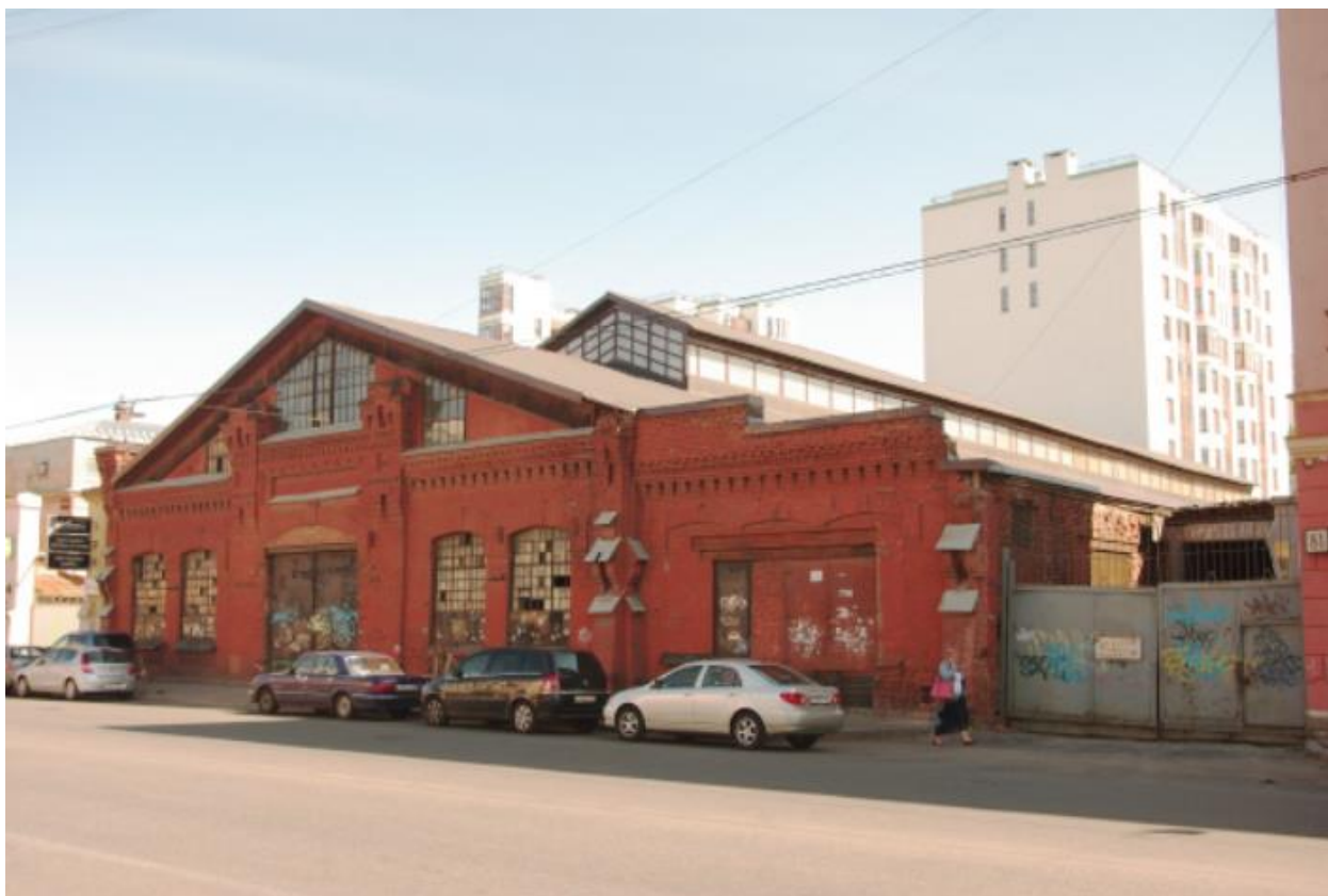
Илл. 117. Вид на здание по адресу: Санкт-Петербург, 16-я линия В.О., 83 в 2012 году (источник: https://kanoner.com/2012/06/04/49059/ ).
