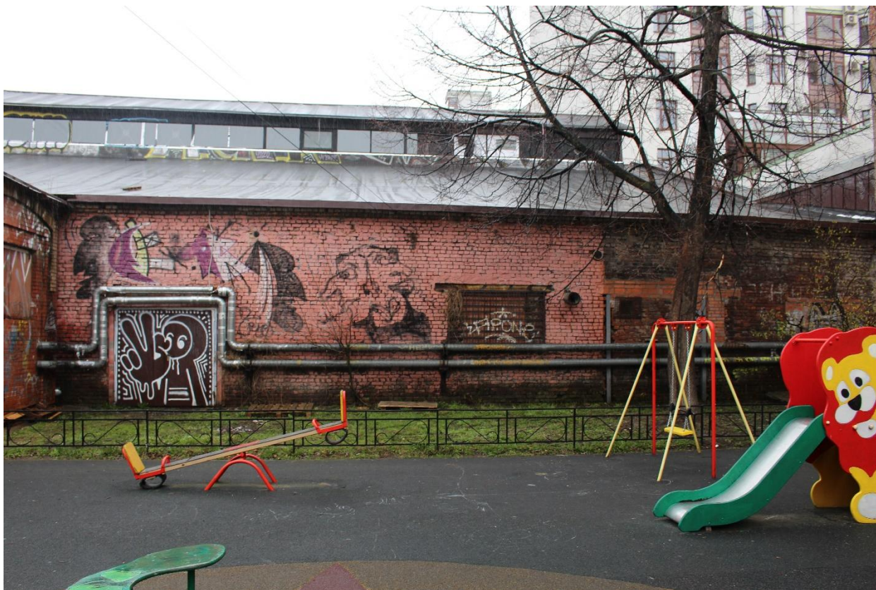
Фото 7. Вид на юго-восточный выявленного объекта культурного наследия «Производственный цех».
