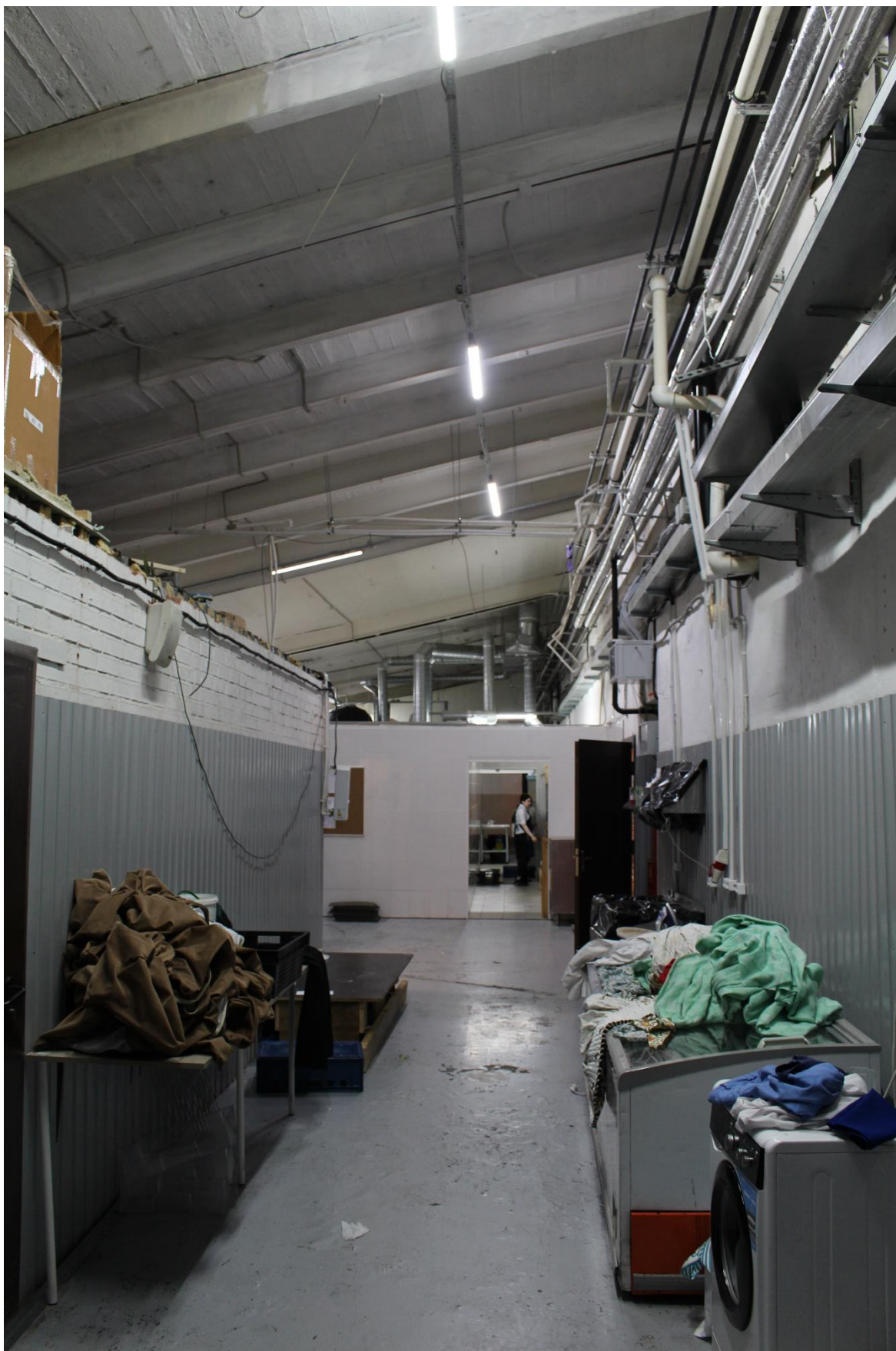
Фото 37. Интерьер внутренних помещений выявленного объекта культурного наследия «Производственный цех».
