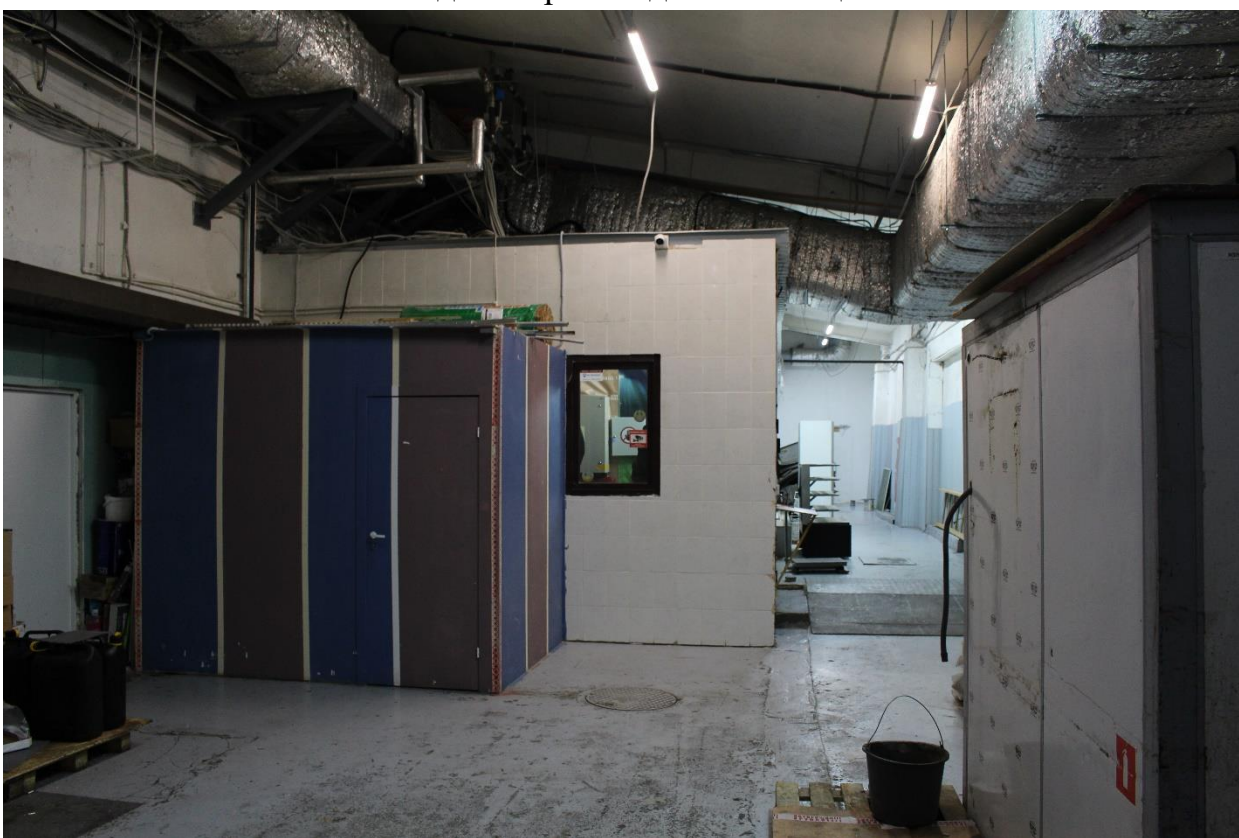
Фото 45. Интерьер внутренних помещений выявленного объекта культурного наследия «Производственный цех».
