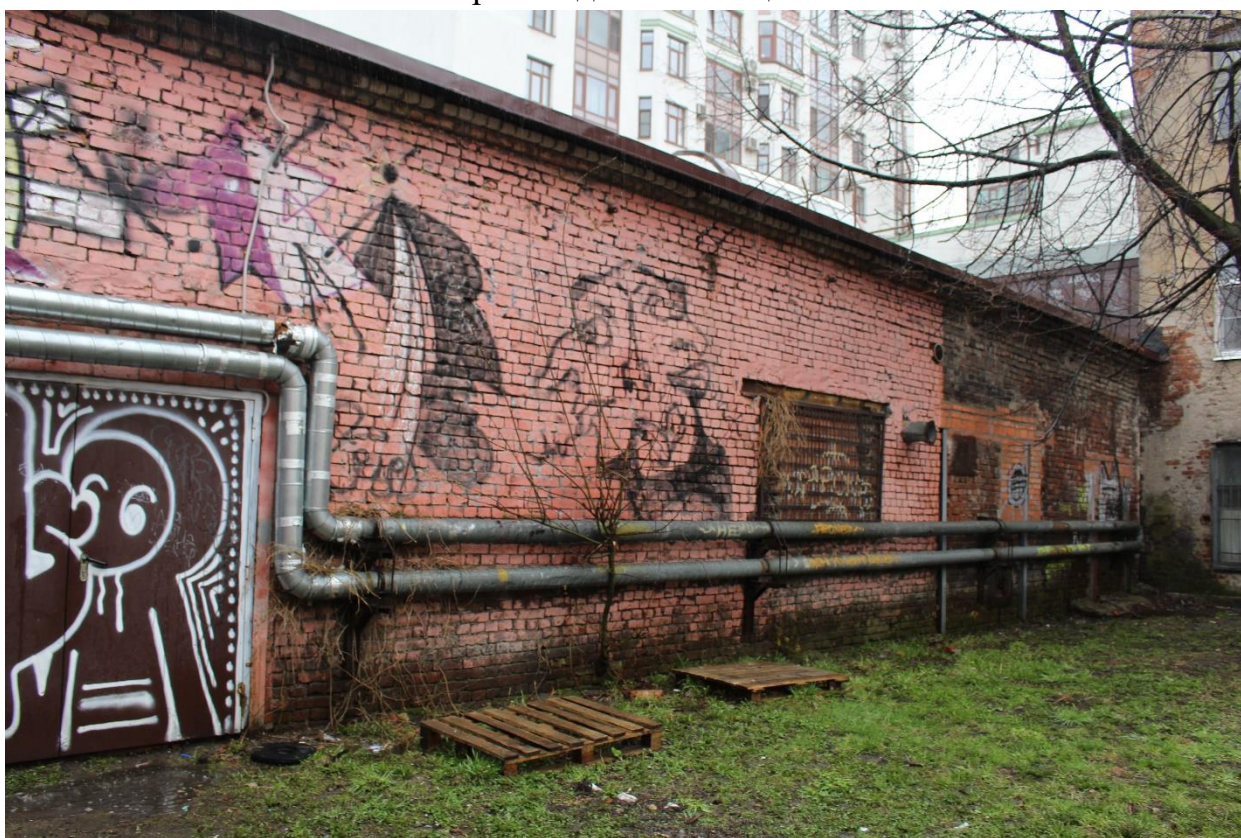
Фото 8. Вид на юго-восточный выявленного объекта культурного наследия «Производственный цех».
