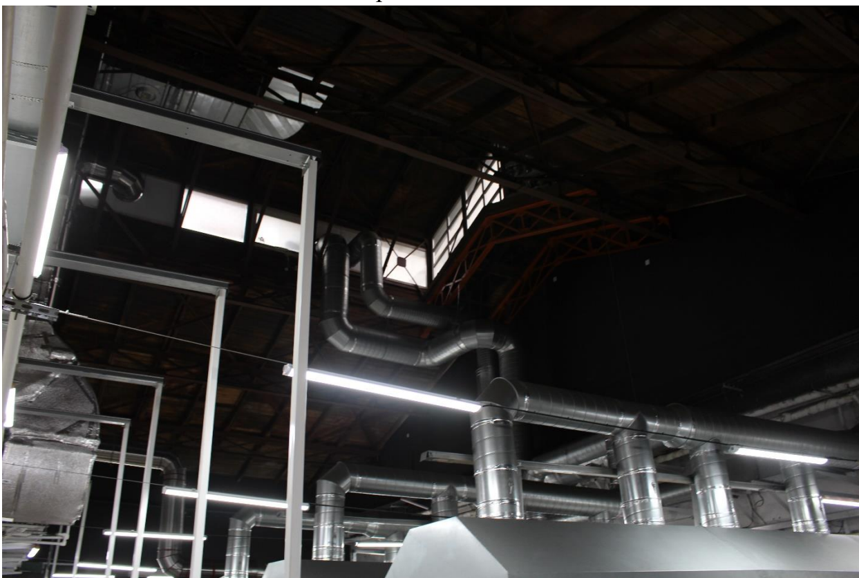
Фото 35. Интерьер внутренних помещений выявленного объекта культурного наследия «Производственный цех».
