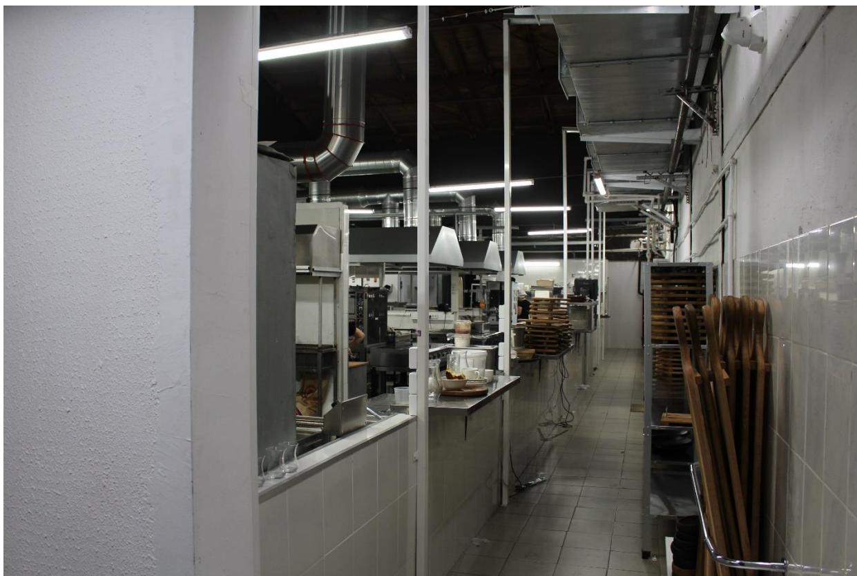
Фото 32. Интерьер внутренних помещений выявленного объекта культурного наследия «Производственный цех».
