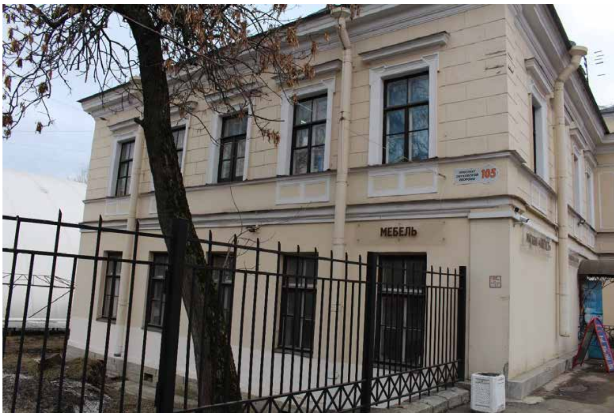
Фото 13. Вид на северо-восточный фасад Флигеля выявленного объекта культурного наследия «Дом культуры текстильщиков (Дворец культуры им. Н.К. Крупской) (с флигелем)».
