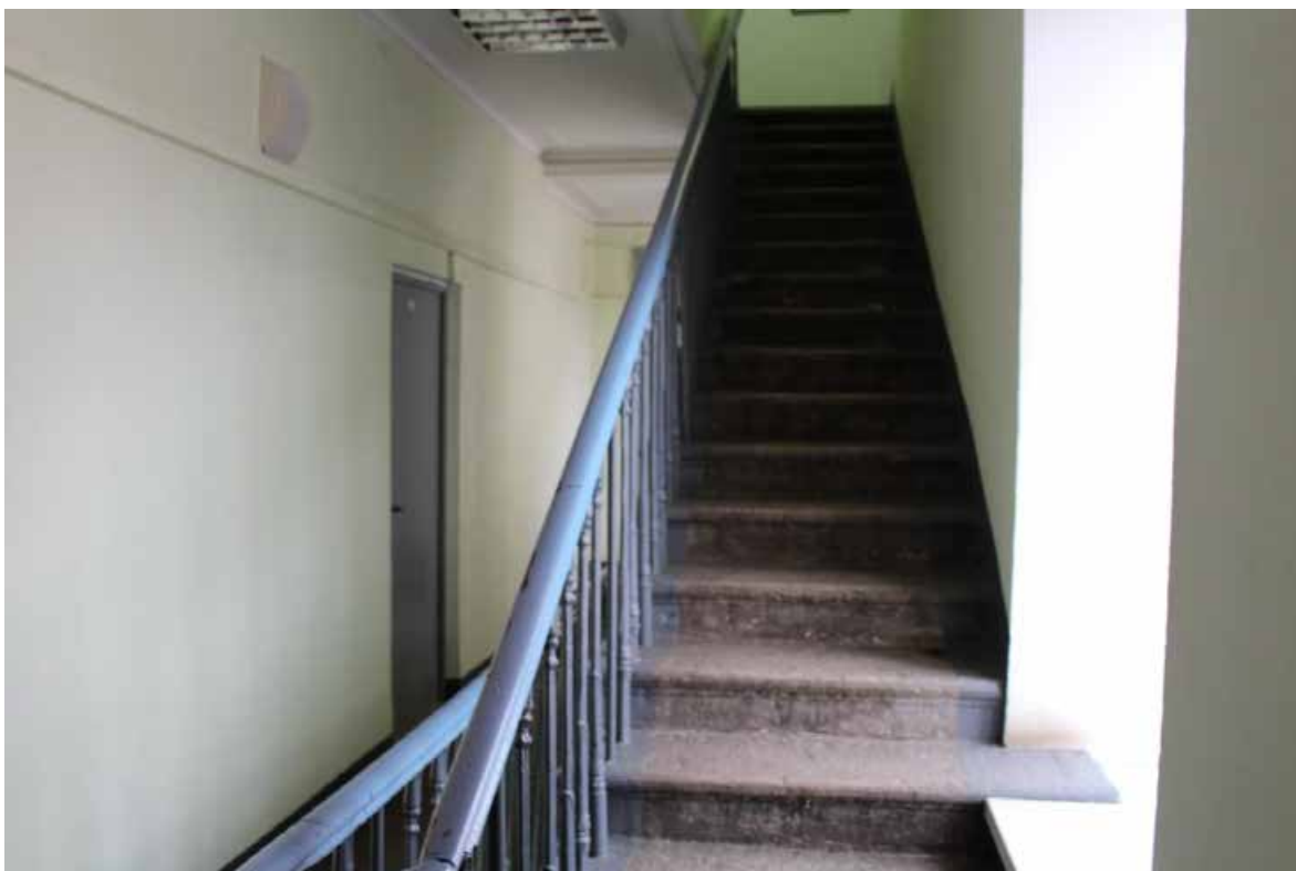
Фото 141. Внутренние помещения выявленного объекта культурного наследия «Дом культуры текстильщиков (Дворец культуры им. Н.К. Крупской) (с флигелем)» Южная лестница Флигеля в уровне 2-го этажа (помещение 11-Н(11) пл. 19,8 кв. м.
