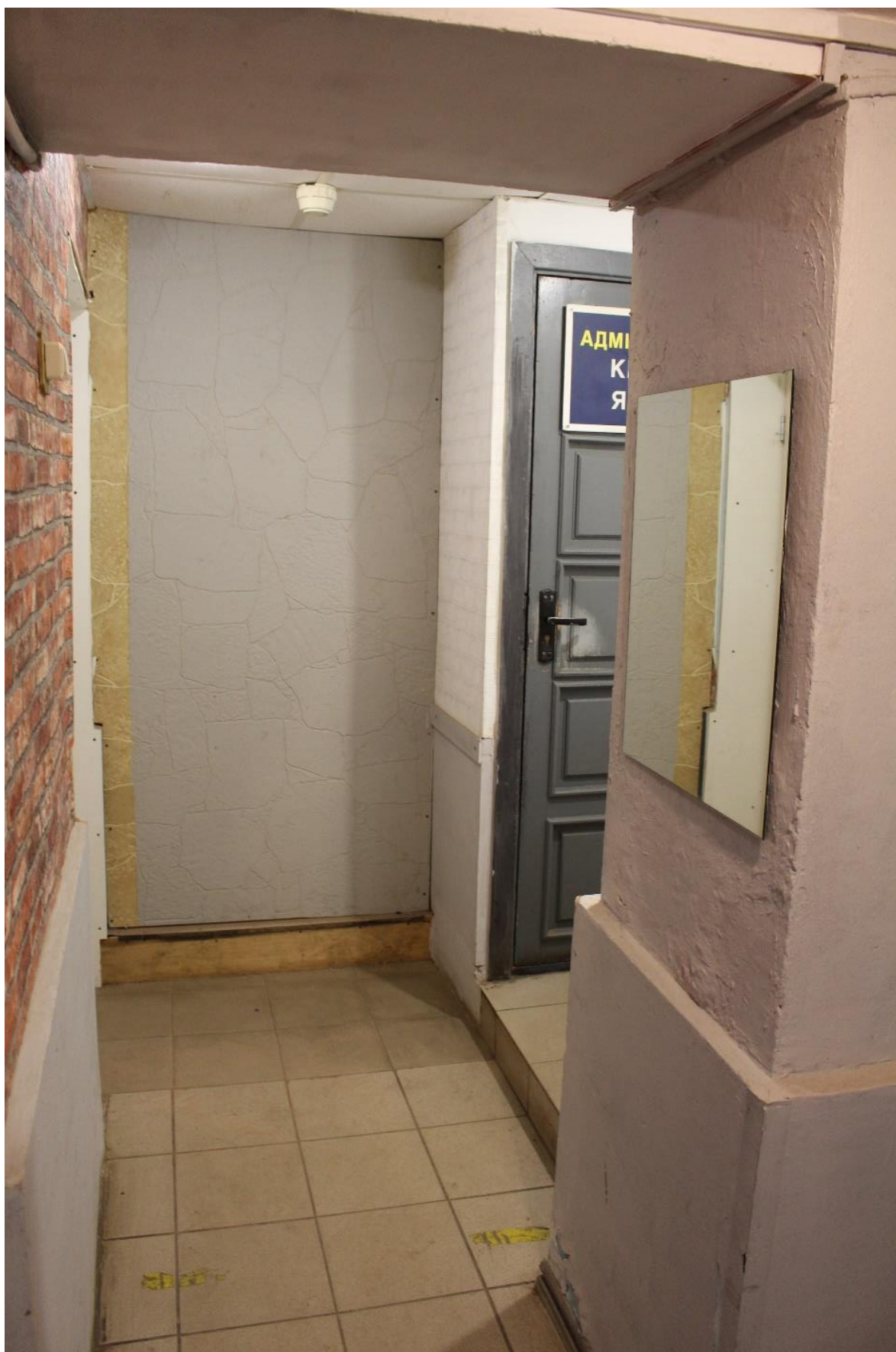
Фото 129. Внутренние помещения 2-го этажа выявленного объекта культурного наследия «Дом культуры текстильщиков (Дворец культуры им. Н.К. Крупской) (с флигелем)». Помещение 4-Н(53) пл. 4,3 кв. м.
