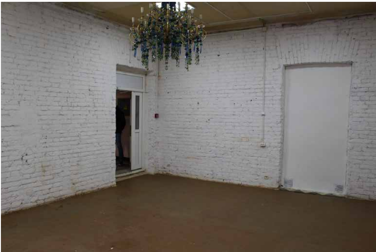
Фото 148. Внутренние помещения 1-го этажа выявленного объекта культурного наследия «Дом культуры текстильщиков (Дворец культуры им. Н.К. Крупской) (с флигелем)». Помещение 4-Н(48, 49, 63).
