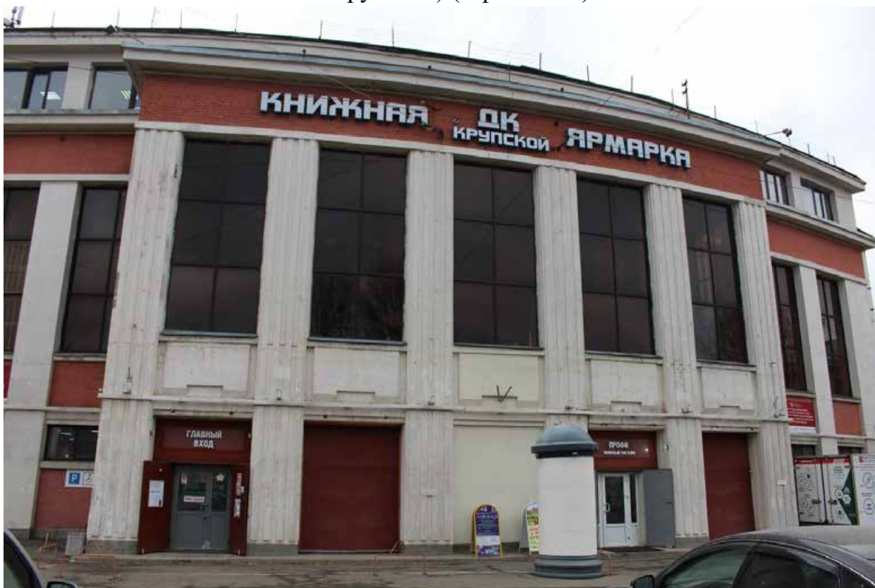
Фото 8. Вид на северо-восточный фасад Дома культуры выявленного объекта культурного наследия «Дом культуры текстильщиков (Дворец культуры им. Н.К. Крупской) (с флигелем)».
