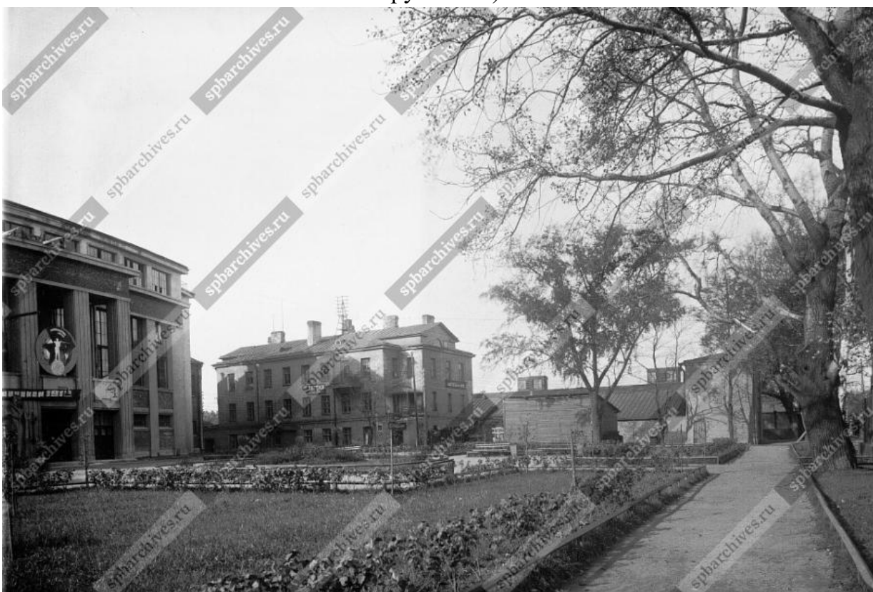
Илл. 61. Фрагмент лицевого фасада Володарского Дома культуры. Фото не ранее осени 1934 г. (1939 г. согласно сведениям в госкаталог.рф № 41234875). (источник: ЦГАКФФД СПб. Фотодокументы. Опись 1ГР-52. Ед.хр.78164).
