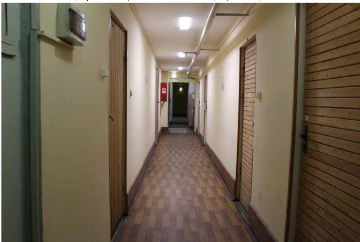
Фото 57. Внутренние помещения 1-го этажа выявленного объекта культурного наследия «Дом культуры текстильщиков (Дворец культуры им. Н.К. Крупской) (с флигелем)». Помещение 4-Н(18) пл. 17,4 кв. м.
