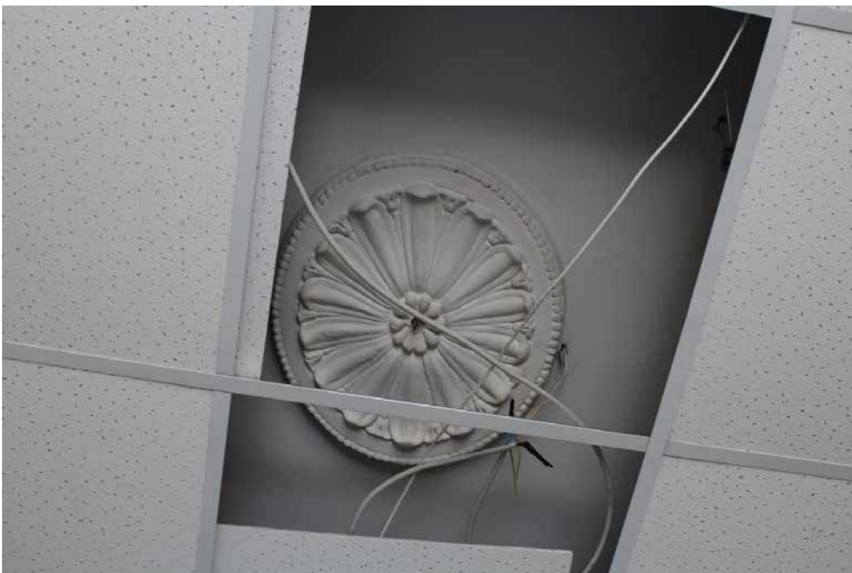
Фото 139. Внутренние помещения 2-го этажа выявленного объекта культурного наследия «Дом культуры текстильщиков (Дворец культуры им. Н.К. Крупской) (с флигелем)». Помещение 11-Н(9) пл. 14,7 кв. м.
