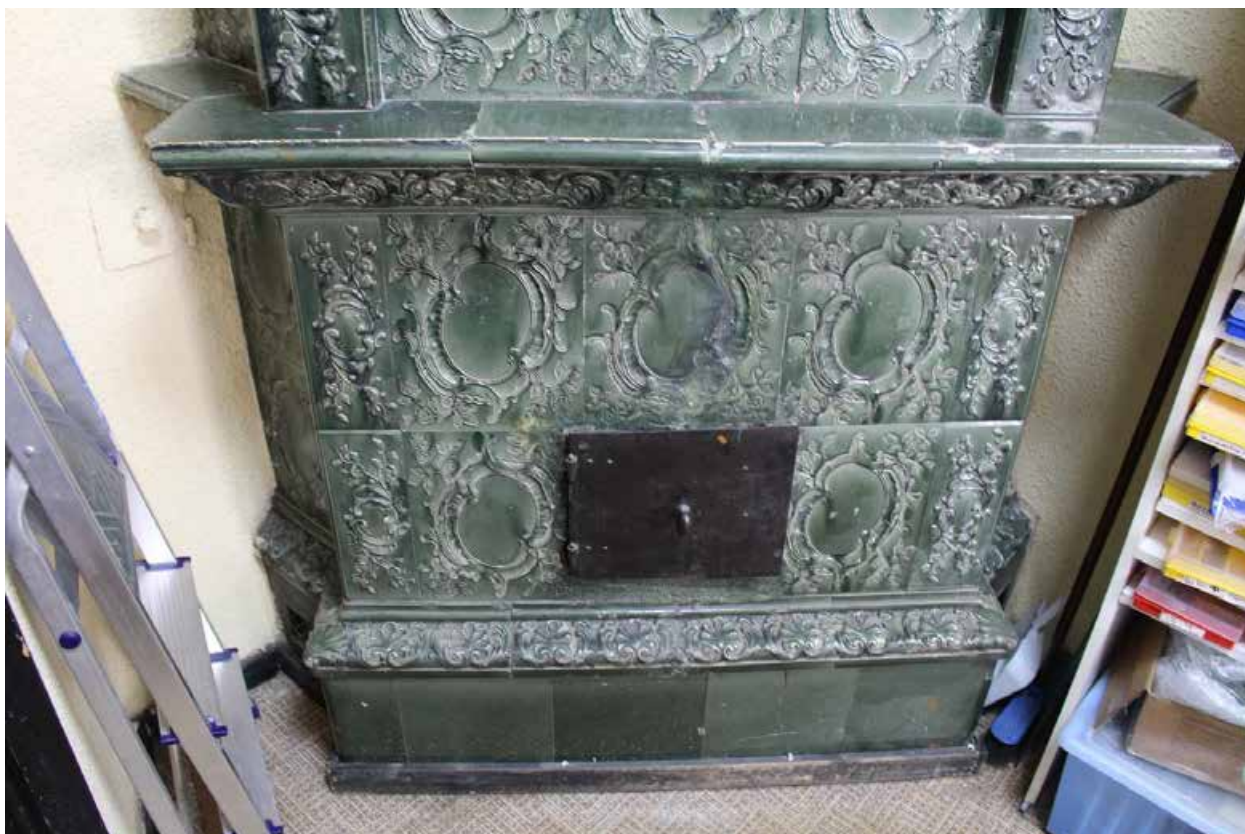
Фото 137. Внутренние помещения 2-го этажа выявленного объекта культурного наследия «Дом культуры текстильщиков (Дворец культуры им. Н.К. Крупской) (с флигелем)». Помещение 11-Н(9) пл. 14,7 кв. м.
