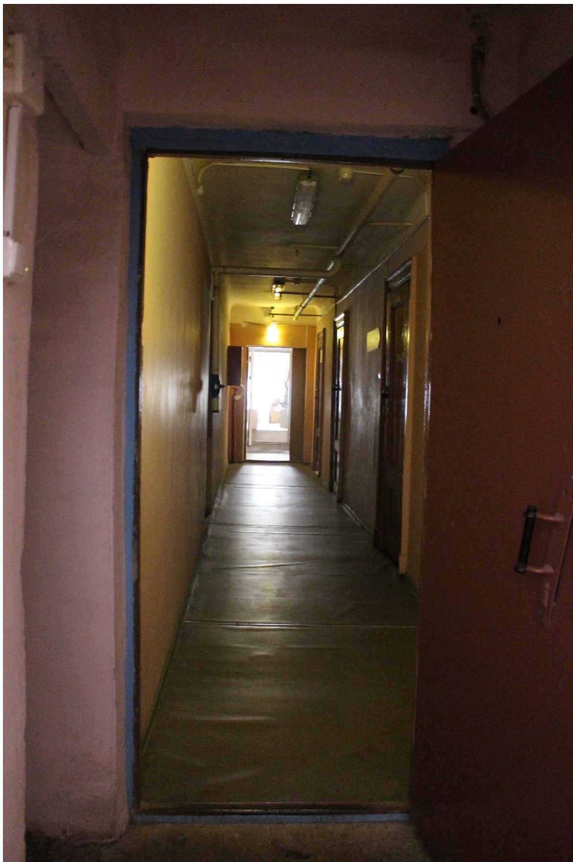
Фото 67. Внутренние помещения 2-го этажа выявленного объекта культурного наследия «Дом культуры текстильщиков (Дворец культуры им. Н.К. Крупской) (с флигелем)». Помещение 11-Н(29) пл. 16,8 кв. м.
