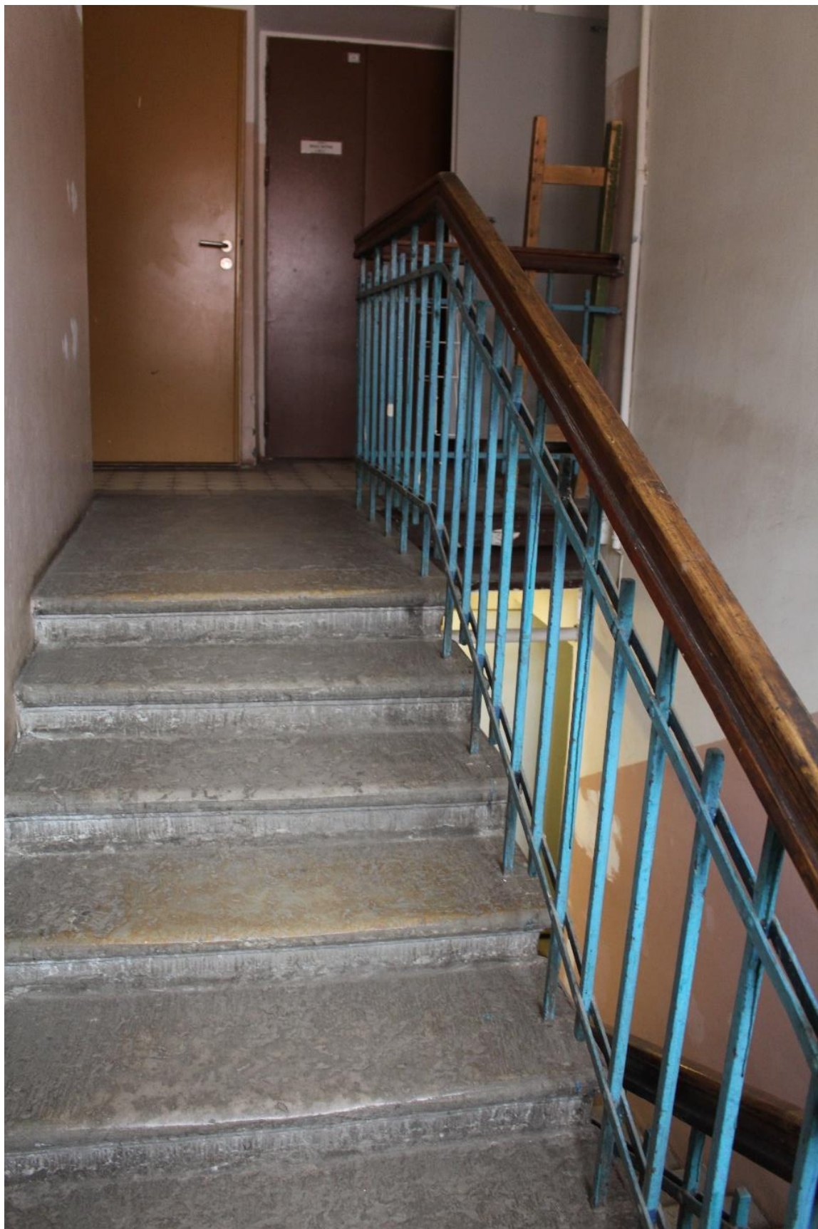
Фото 63. Внутренние помещения выявленного объекта культурного наследия «Дом культуры текстильщиков (Дворец культуры им. Н.К. Крупской) (с флигелем)». Западная служебная лестница Дома культуры в уровне 2-го этажа (помещение 11-Н(82) пл. 11,3 кв. м).
