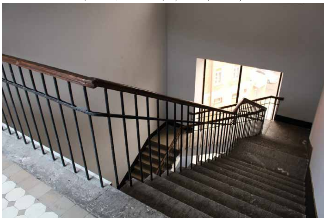
Фото 91. Внутренние помещения выявленного объекта культурного наследия «Дом культуры текстильщиков (Дворец культуры им. Н.К. Крупской) (с флигелем)». Западная парадная лестница в уровне 3-го этажа (помещение 17-Н(19) пл. 59,0 кв. м).
