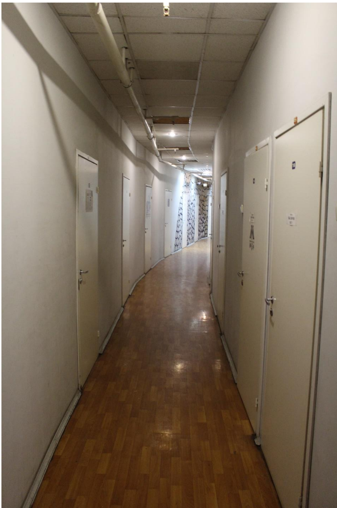
Фото 122. Внутренние помещения 3-го этажа выявленного объекта культурного наследия «Дом культуры текстильщиков (Дворец культуры им. Н.К. Крупской) (с флигелем)». Помещение 17-Н(1) пл. 94,0 кв. м.
