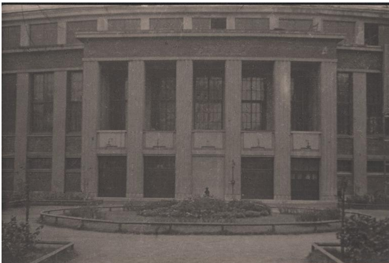
Илл. 62. Дом культуры текстильщиков на проспекте Обуховской обороны, дом № 105. Фото не ранее осени 1934 г. (источник: госкаталог.рф № 12101559).
