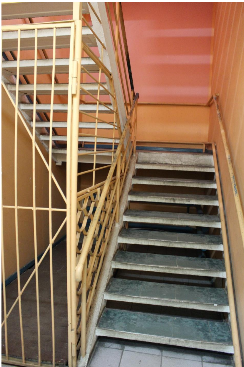
Фото 51. Внутренние помещения выявленного объекта культурного наследия «Дом культуры текстильщиков (Дворец культуры им. Н.К. Крупской) (с флигелем)». Служебная лестница в уровне 1-го этажа (помещение 4-Н(87) пл. 12,6 кв. м).
