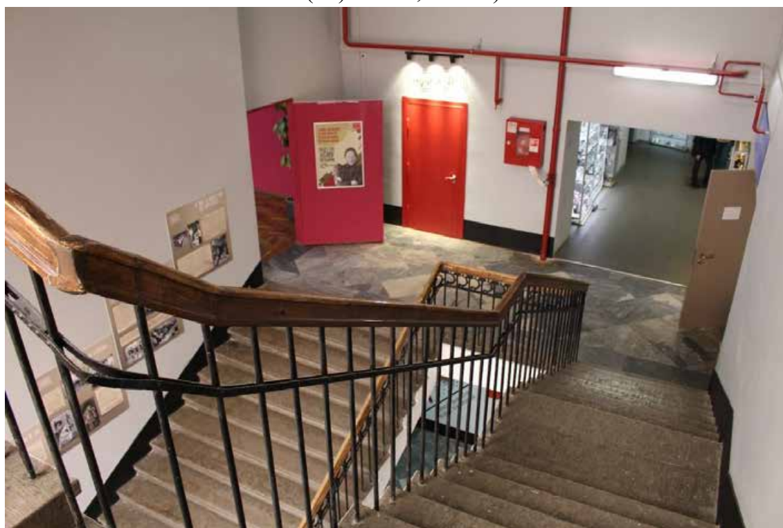
Фото 89. Внутренние помещения выявленного объекта культурного наследия «Дом культуры текстильщиков (Дворец культуры им. Н.К. Крупской) (с флигелем)». Западная парадная лестница в уровне 2-го этажа (помещение 11-Н(80) пл. 59,0 кв. м).
