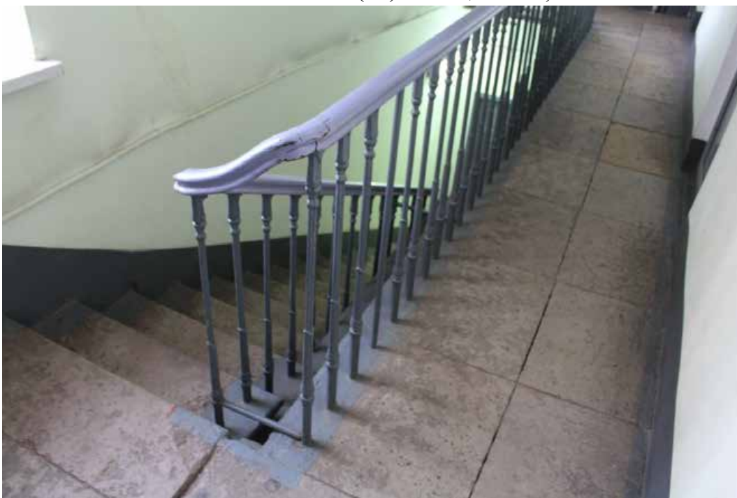
Фото 133. Внутренние помещения выявленного объекта культурного наследия «Дом культуры текстильщиков (Дворец культуры им. Н.К. Крупской) (с флигелем)» Южная лестница Флигеля в уровне 2-го этажа (помещение 11-Н(11) пл. 19,8 кв. м).
