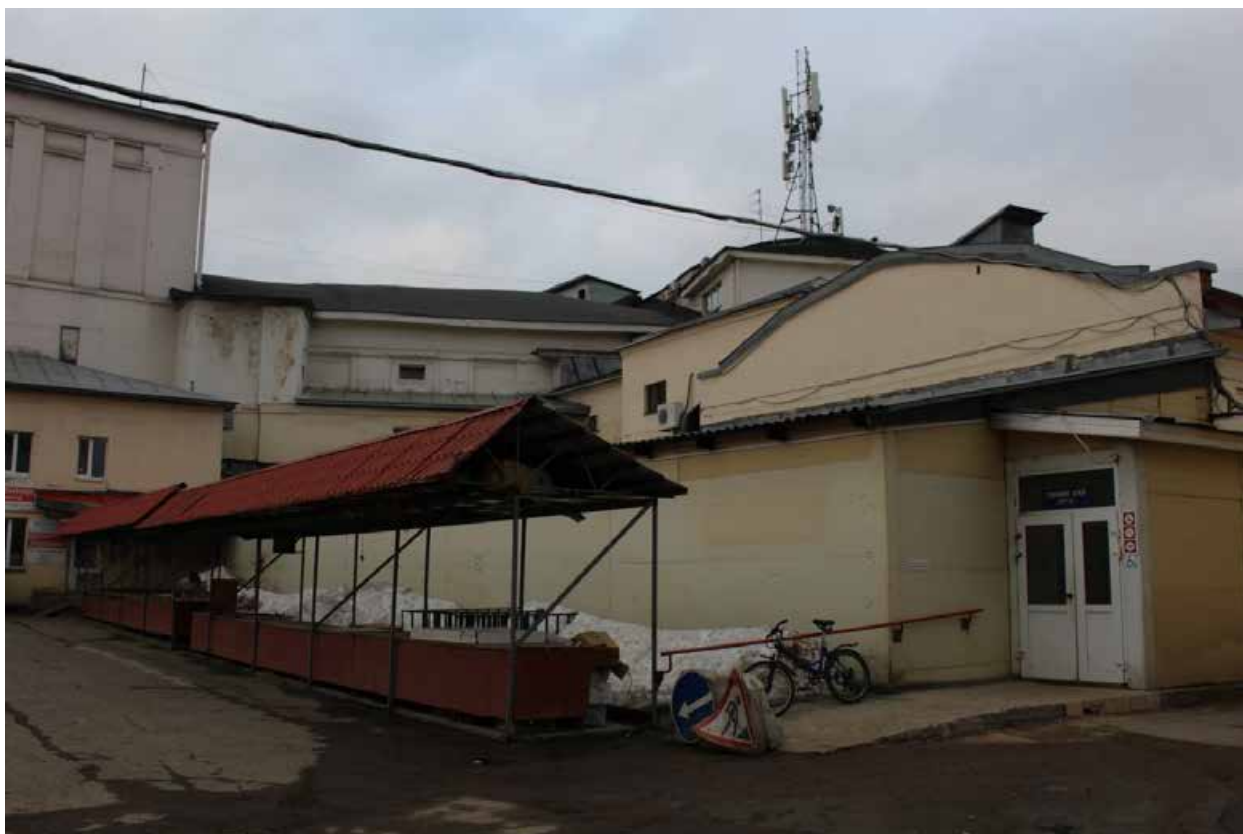
Фото 21. Вид на поздние пристройки к Дому культуры и Флигелю выявленного объекта культурного наследия «Дом культуры текстильщиков (Дворец культуры им. Н.К. Крупской) (с флигелем)» с юга.
