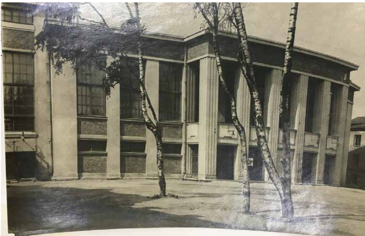
Илл. 48. Володарский Дом культуры. Фото 1932 г. (источник: архив КГИОП Фототека № 106921/2).
