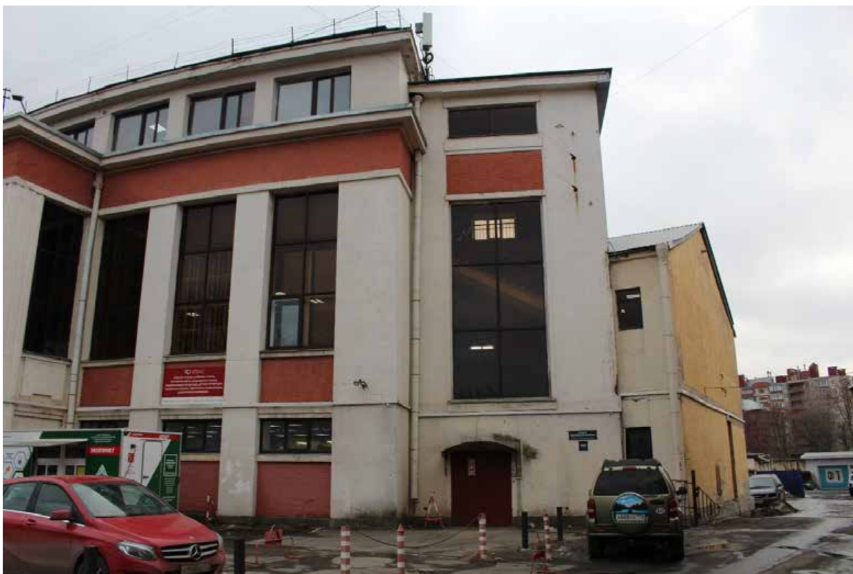
Фото 5. Вид на северо-восточный фасад Дома культуры выявленного объекта культурного наследия «Дом культуры текстильщиков (Дворец культуры им. Н.К. Крупской) (с флигелем)».
