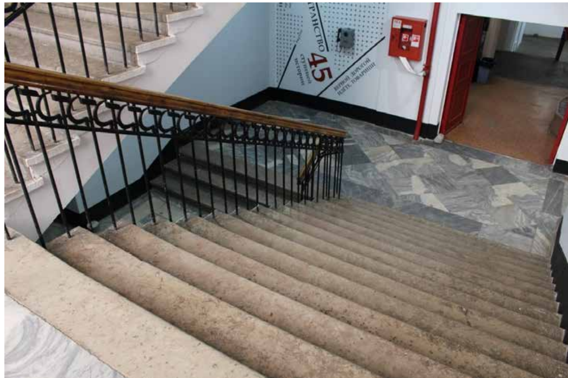
Фото 87. Внутренние помещения выявленного объекта культурного наследия «Дом культуры текстильщиков (Дворец культуры им. Н.К. Крупской) (с флигелем)». Западная парадная лестница в уровне 1-го этажа (помещение 4-Н(84)пл. 37,9 кв. м).
