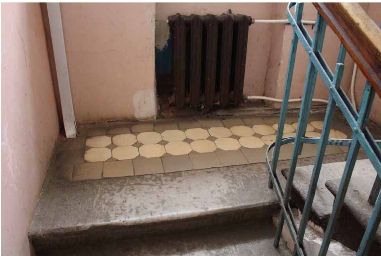
Фото 61. Внутренние помещения выявленного объекта культурного наследия «Дом культуры текстильщиков (Дворец культуры им. Н.К. Крупской) (с флигелем)». Западная служебная лестница Дома культуры в уровне 1-го – 2-го этажей (помещение 4-Н(86) пл. 12,9 кв. м).
