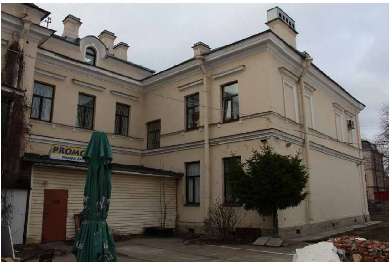
Фото 15. Вид на юго-восточный фасад Флигеля выявленного объекта культурного наследия «Дом культуры текстильщиков (Дворец культуры им. Н.К. Крупской) (с флигелем)».
