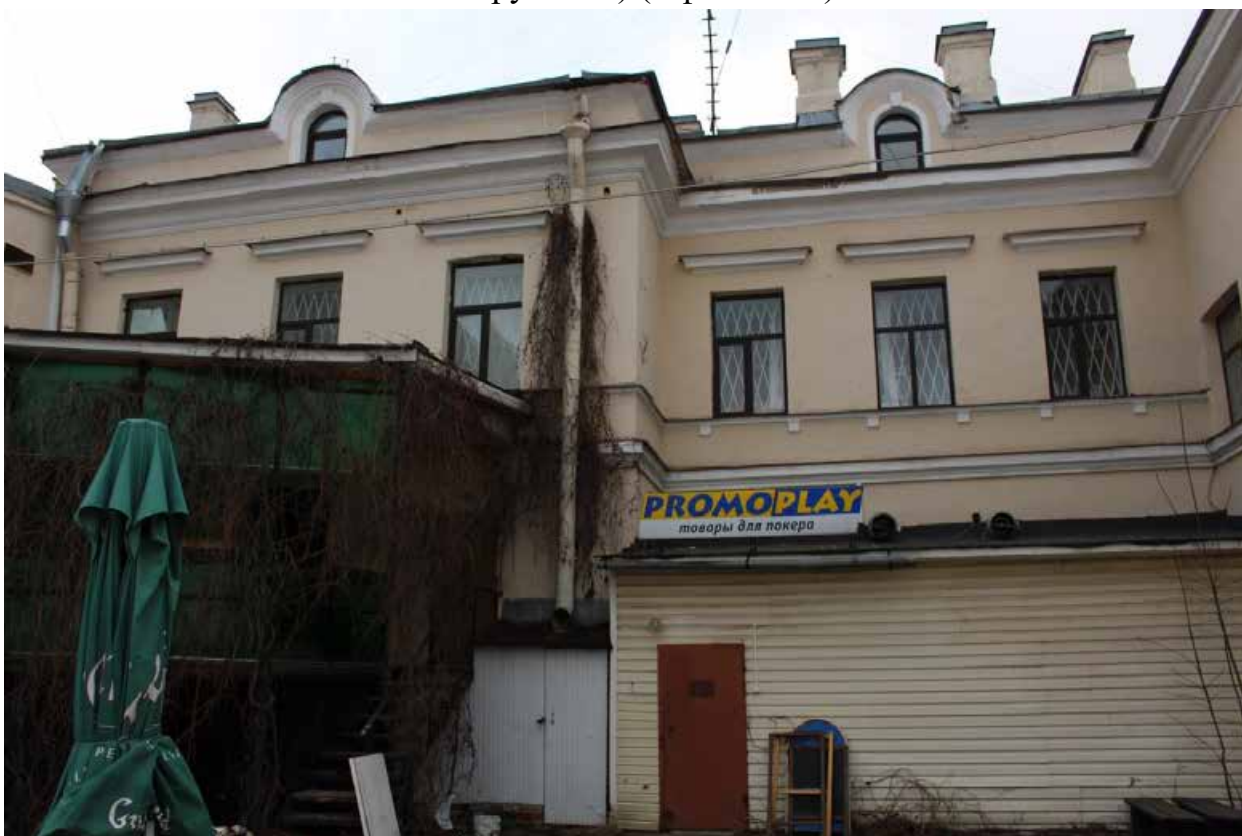
Фото 16. Вид на юго-восточный фасад Флигеля выявленного объекта культурного наследия «Дом культуры текстильщиков (Дворец культуры им. Н.К. Крупской) (с флигелем)».
