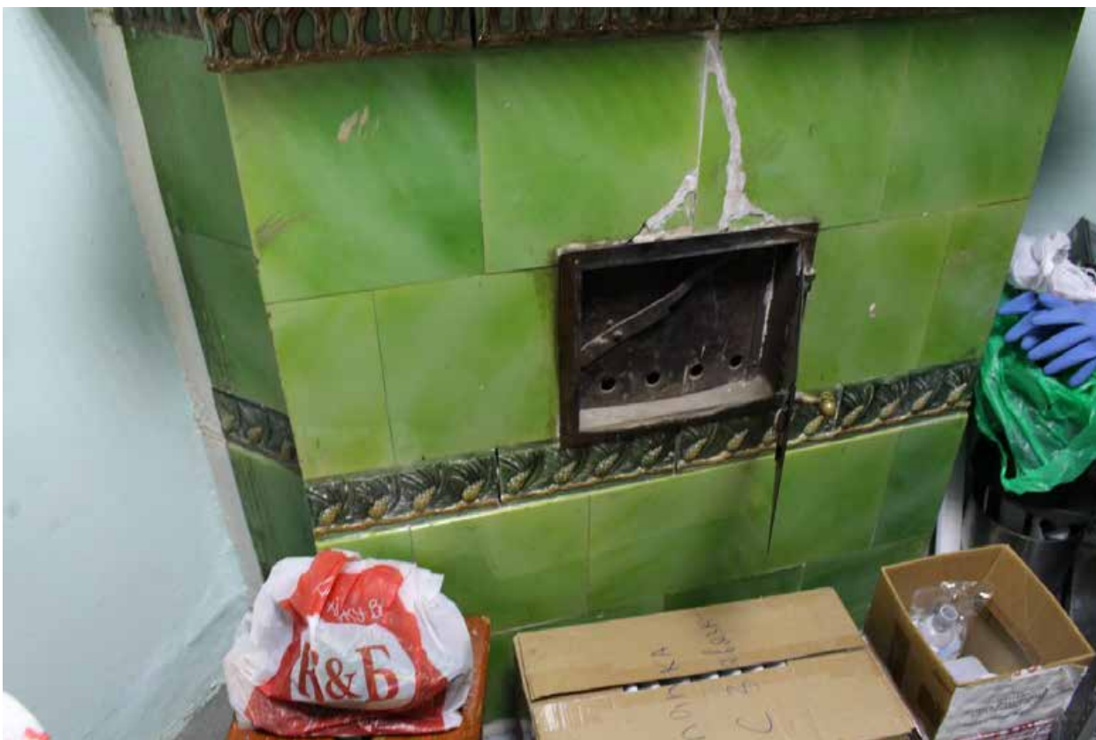
Фото 155. Внутренние помещения 2-го этажа выявленного объекта культурного наследия «Дом культуры текстильщиков (Дворец культуры им. Н.К. Крупской) (с флигелем)». Помещение 11-Н(1) пл. 41,0 кв. м.
