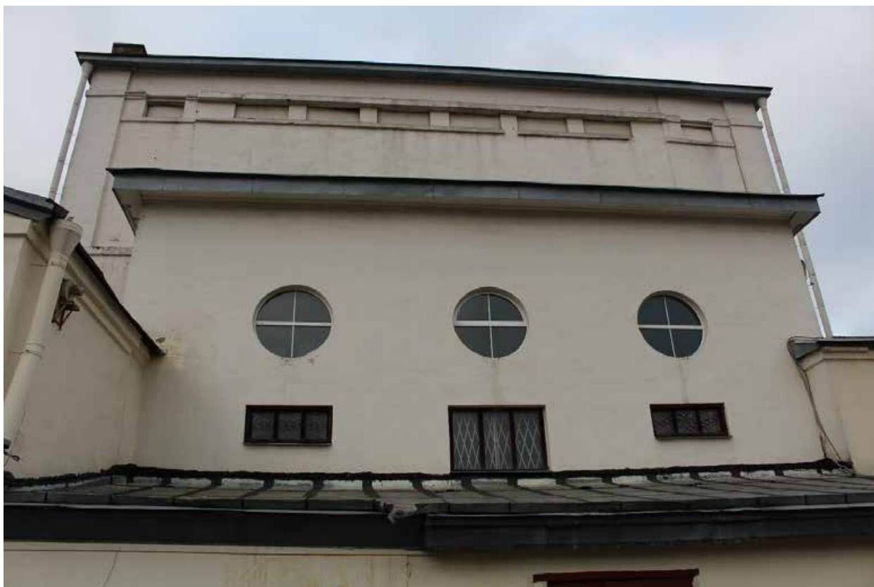
Фото 27. Вид на юго-западный фасад Дома культуры выявленного объекта культурного наследия «Дом культуры текстильщиков (Дворец культуры им. Н.К. Крупской) (с флигелем)»
