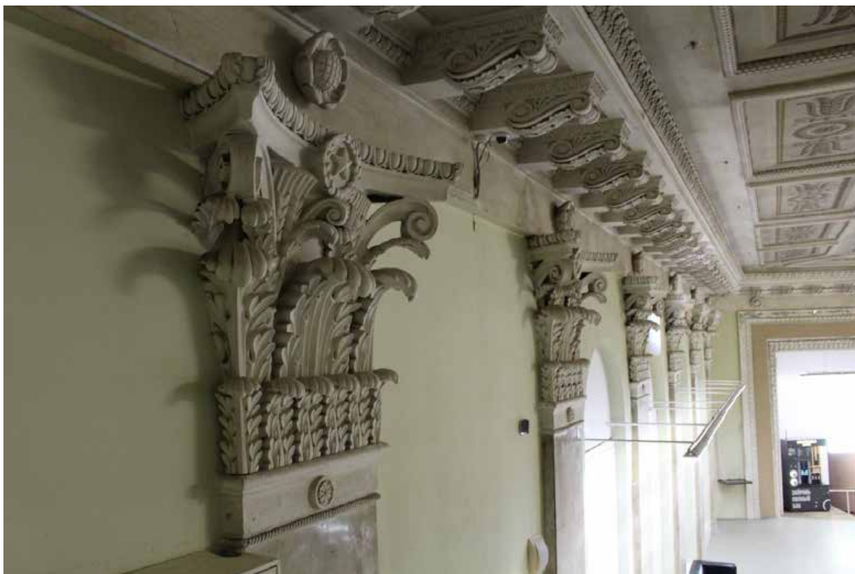
Фото 99. Внутренние помещения 2-го этажа выявленного объекта культурного наследия «Дом культуры текстильщиков (Дворец культуры им. Н.К. Крупской) (с флигелем)». Помещение 11-Н(66) пл. 297,1 кв. м.
