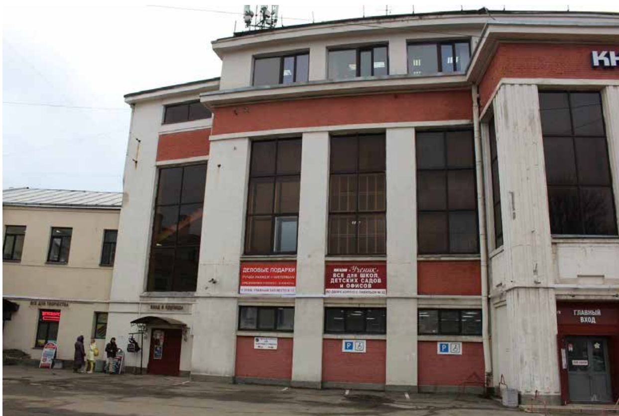
Фото 9. Вид на северо-восточный фасад Дома культуры выявленного объекта культурного наследия «Дом культуры текстильщиков (Дворец культуры им. Н.К. Крупской) (с флигелем)».
