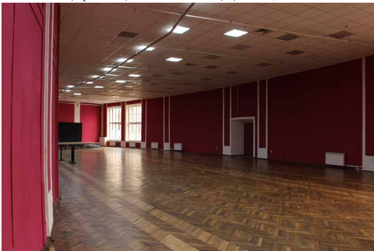
Фото 114. Внутренние помещения 2-го этажа выявленного объекта культурного наследия «Дом культуры текстильщиков (Дворец культуры им. Н.К. Крупской) (с флигелем)». Помещение 11-Н(60) пл. 401,2 кв. м.
