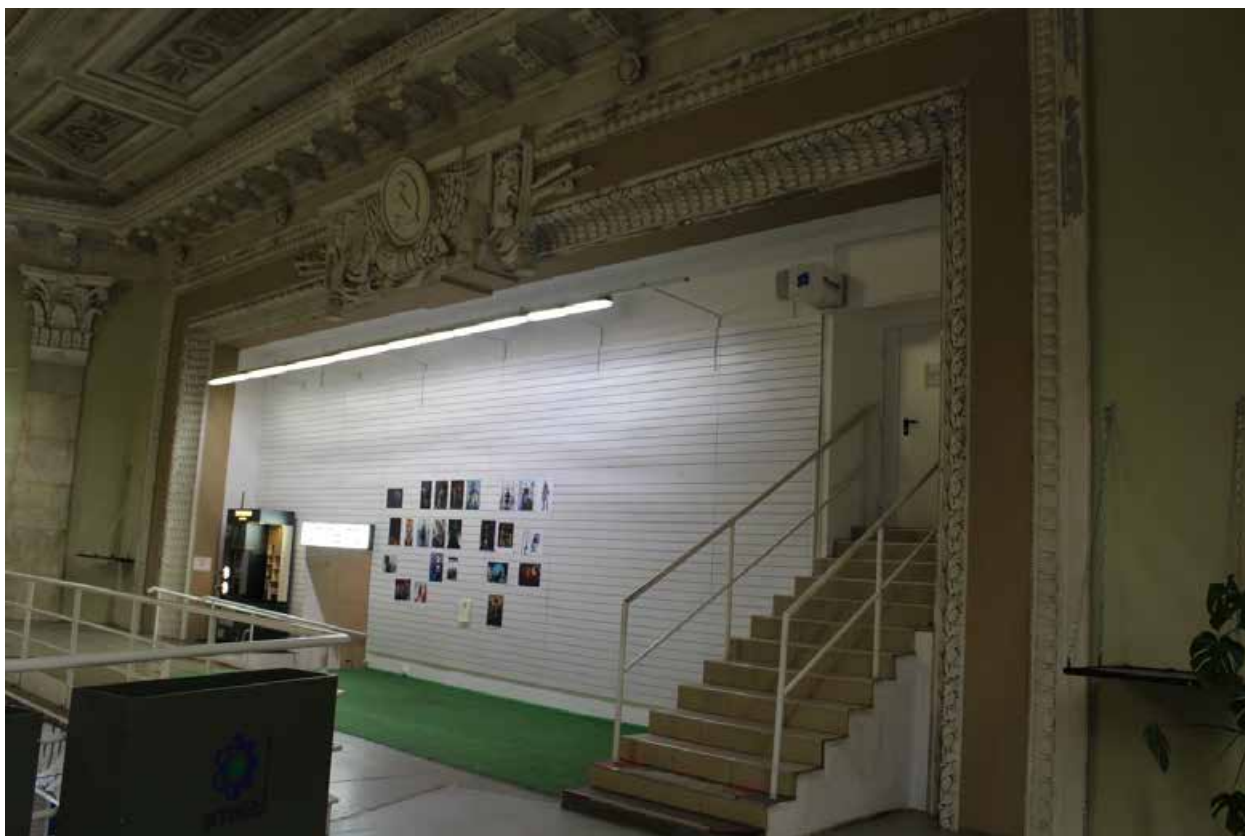
Фото 103. Внутренние помещения 2-го этажа выявленного объекта культурного наследия «Дом культуры текстильщиков (Дворец культуры им. Н.К. Крупской) (с флигелем)». Помещение 11-Н(66) пл. 297,1 кв. м.
