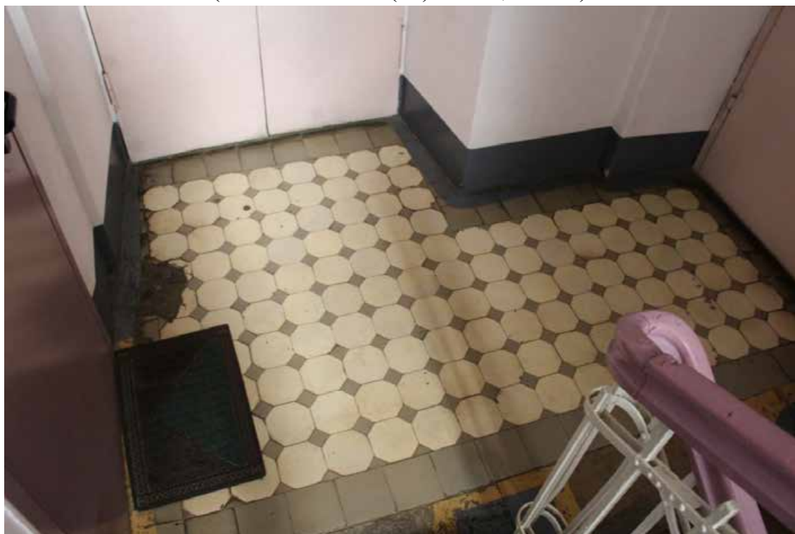
Фото 124. Внутренние помещения выявленного объекта культурного наследия «Дом культуры текстильщиков (Дворец культуры им. Н.К. Крупской) (с флигелем)». Восточная служебная лестница Дома культуры в уровне 1-го этажа (помещение 4-Н(85) пл. 12,4 кв. м).
