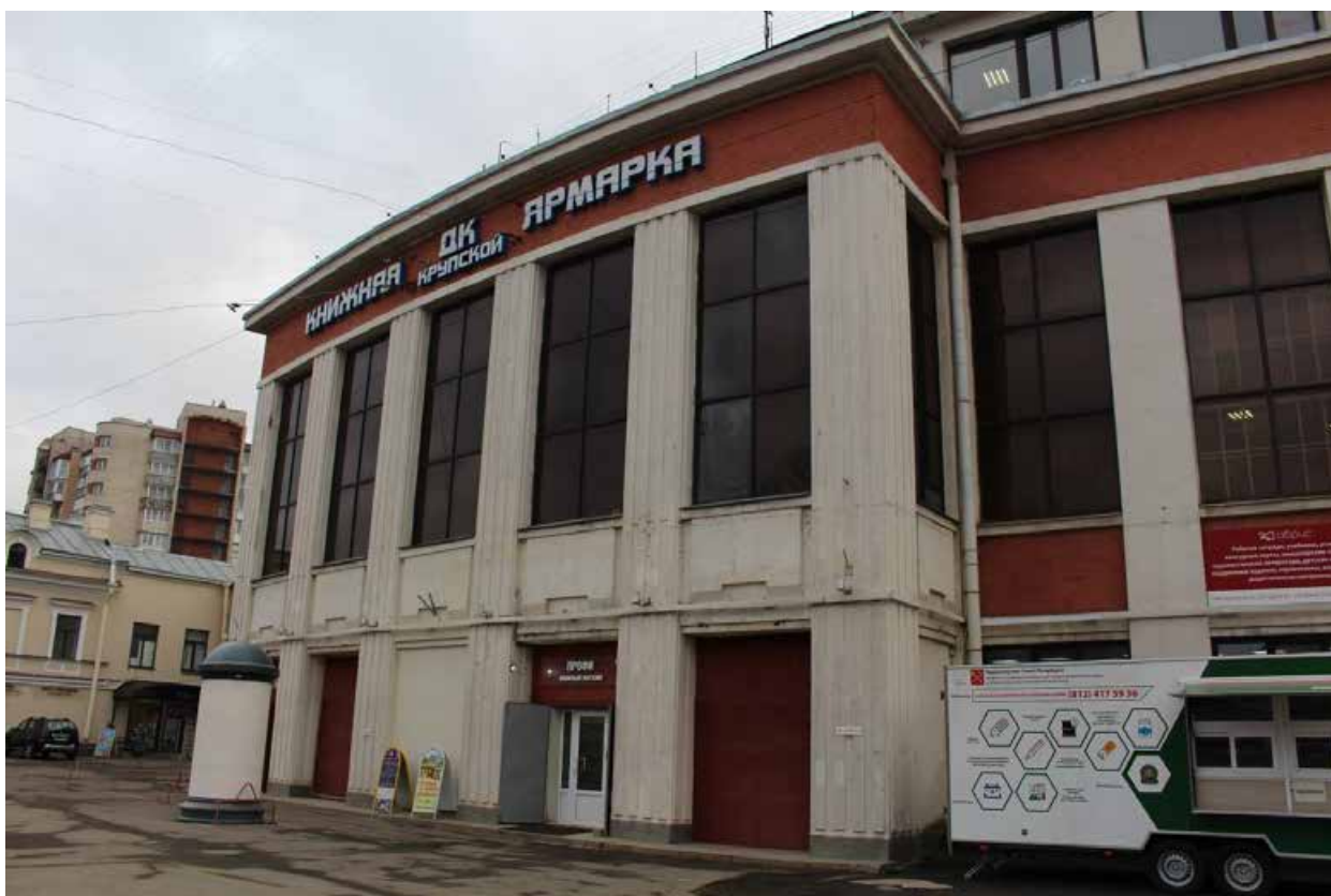
Фото 7. Вид на северо-восточный фасад Дома культуры выявленного объекта культурного наследия «Дом культуры текстильщиков (Дворец культуры им. Н.К. Крупской) (с флигелем)».
