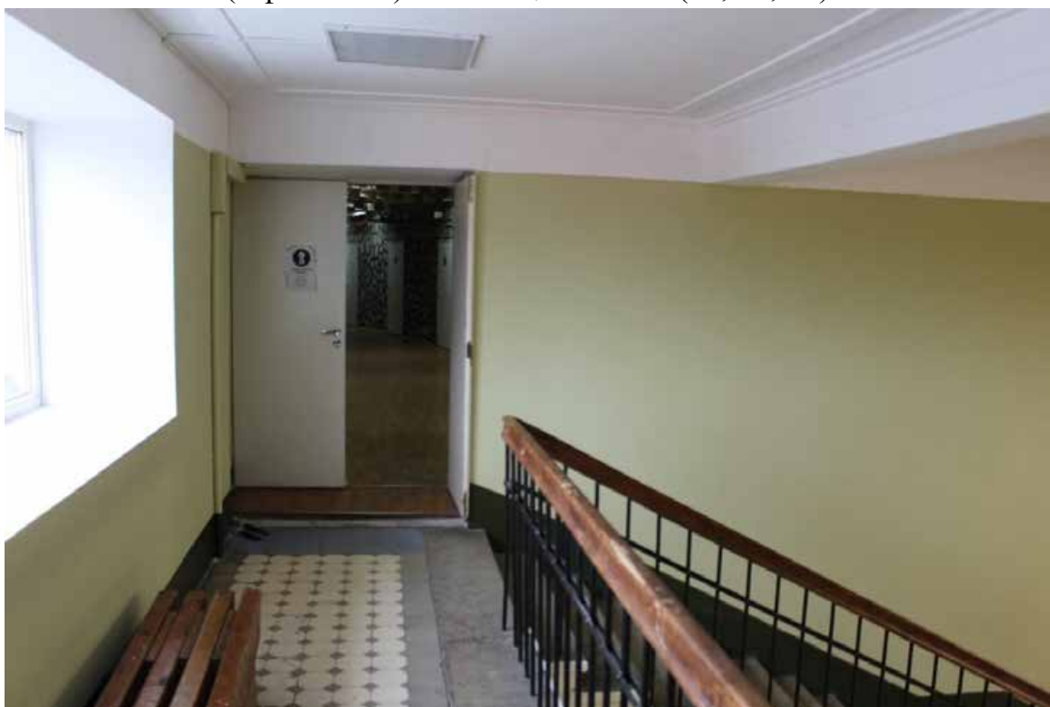
Фото 118. Внутренние помещения выявленного объекта культурного наследия «Дом культуры текстильщиков (Дворец культуры им. Н.К. Крупской) (с флигелем)». Восточная парадная лестница в уровне 3-го этажа (помещение 17-Н(18) пл. 60,0 кв. м).
