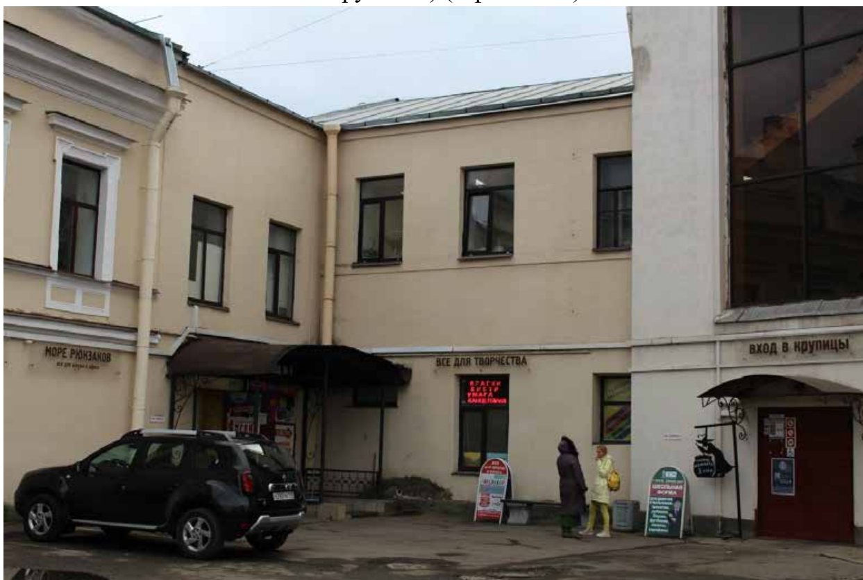
Фото 10. Вид на северо-восточный фасад пристройки к Дому культуры выявленного объекта культурного наследия «Дом культуры текстильщиков (Дворец культуры им. Н.К. Крупской) (с флигелем)».
