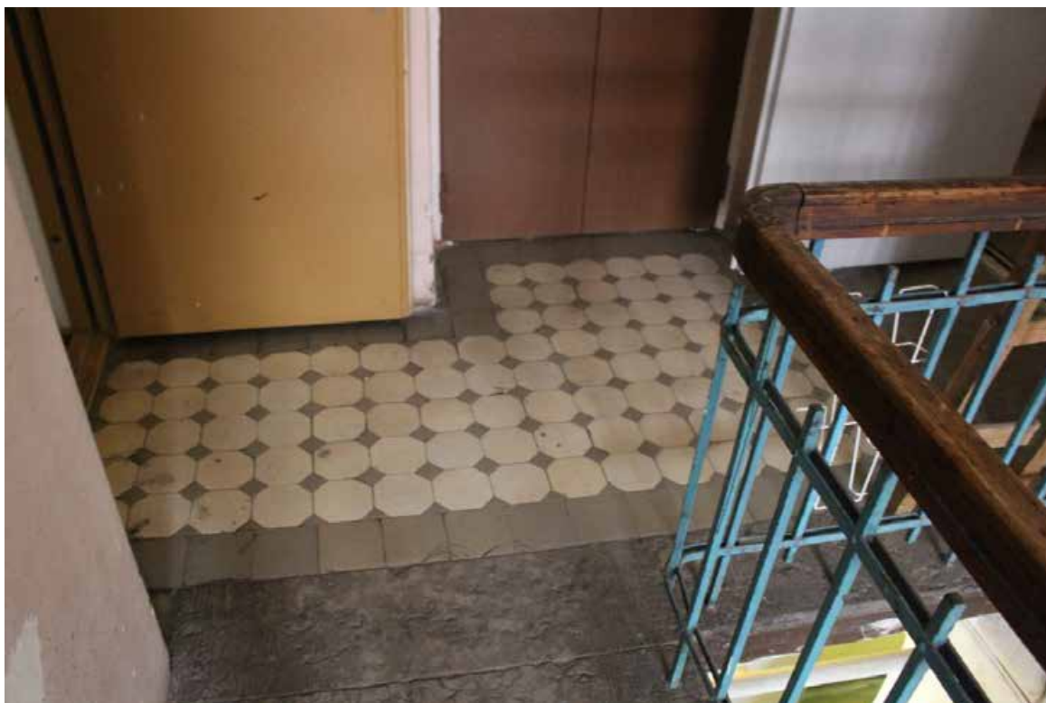
Фото 64. Внутренние помещения выявленного объекта культурного наследия «Дом культуры текстильщиков (Дворец культуры им. Н.К. Крупской) (с флигелем)». Западная служебная лестница Дома культуры в уровне 2-го этажа (помещение 11-Н(82) пл. 11,3 кв. м).
