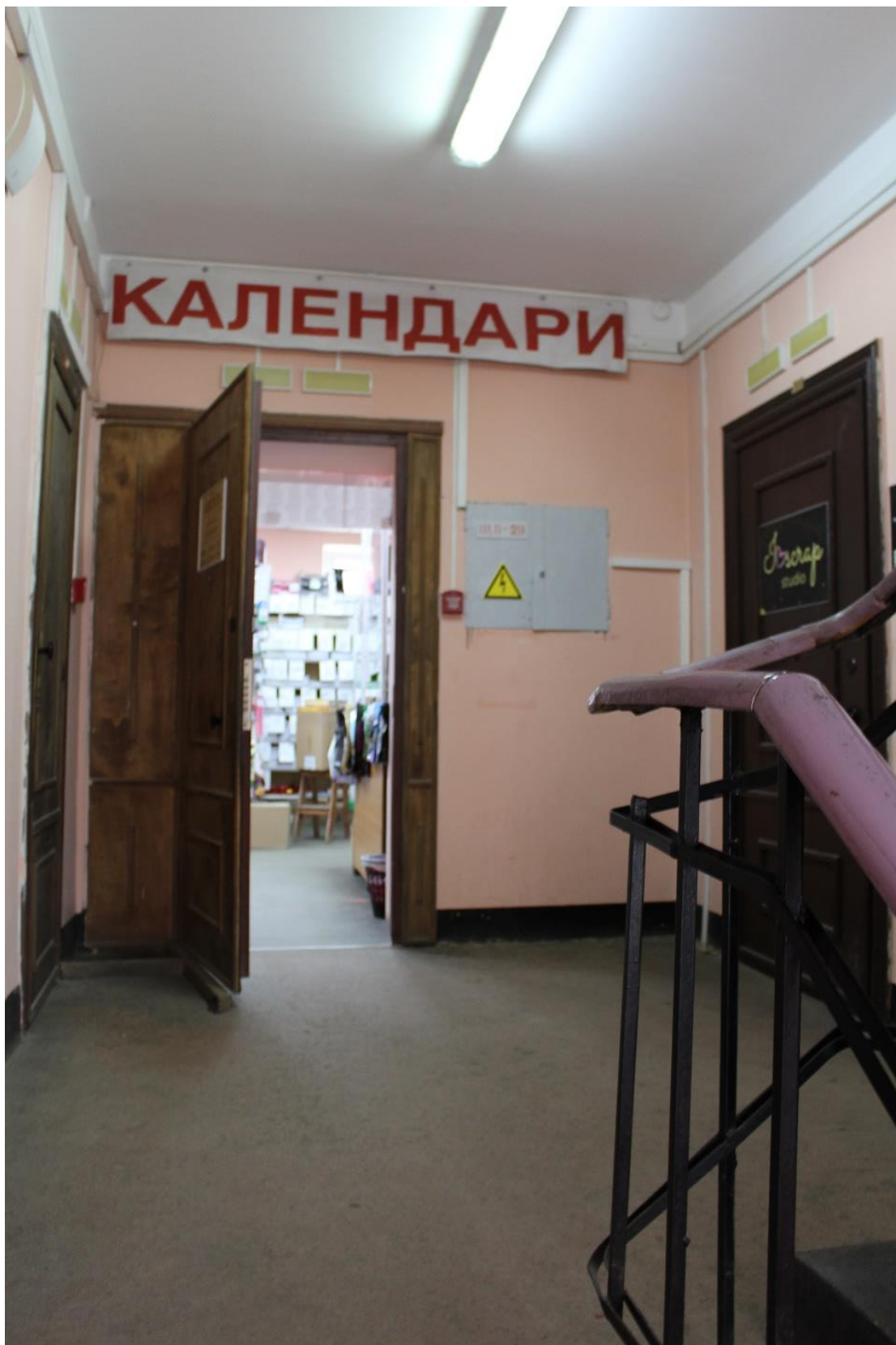
Фото 151. Внутренние помещения выявленного объекта культурного наследия «Дом культуры текстильщиков (Дворец культуры им. Н.К. Крупской) (с флигелем)» Северная лестница Флигеля в уровне 2-го этажа (помещение 11-Н(4) пл. 20,0 кв. м).
