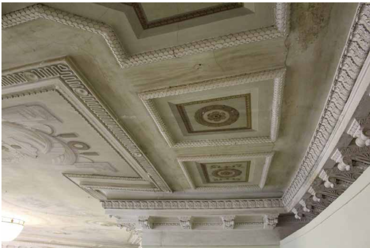
Фото 97. Внутренние помещения 2-го этажа выявленного объекта культурного наследия «Дом культуры текстильщиков (Дворец культуры им. Н.К. Крупской) (с флигелем)». Помещение 11-Н(66) пл. 297,1 кв. м.
