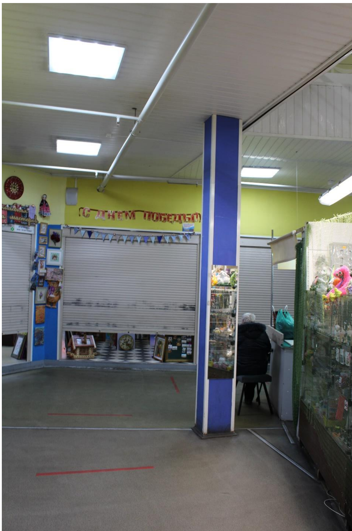
Фото 46. Внутренние помещения 1-го этажа выявленного объекта культурного наследия «Дом культуры текстильщиков (Дворец культуры им. Н.К. Крупской) (с флигелем)». Помещение 4-Н(13) пл. 426,8 кв. м.
