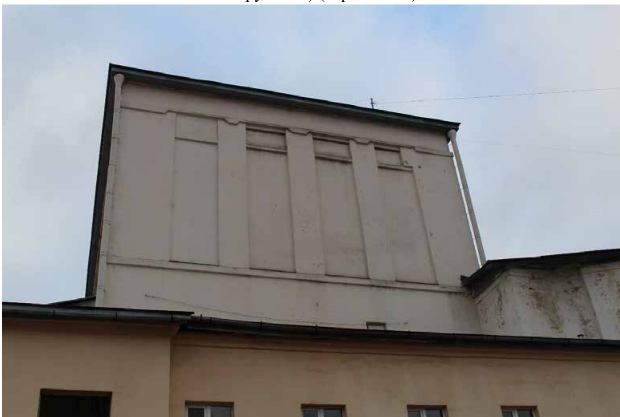
Фото 24. Вид на юго-восточный фасад сценической коробки Дома культуры выявленного объекта культурного наследия «Дом культуры текстильщиков (Дворец культуры им. Н.К. Крупской) (с флигелем)».
