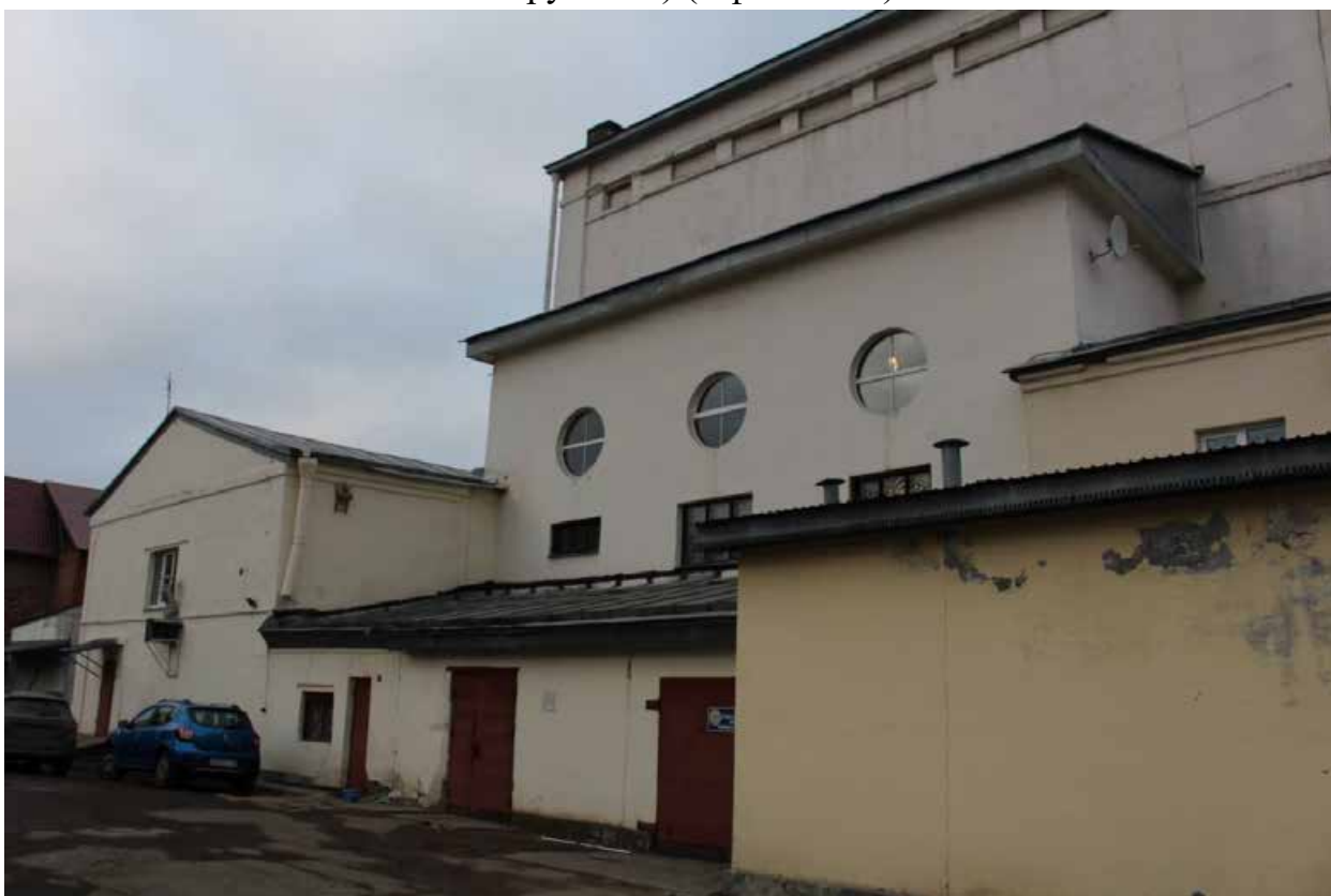
Фото 26. Вид на юго-западный фасад Дома культуры выявленного объекта культурного наследия «Дом культуры текстильщиков (Дворец культуры им. Н.К. Крупской) (с флигелем)».
