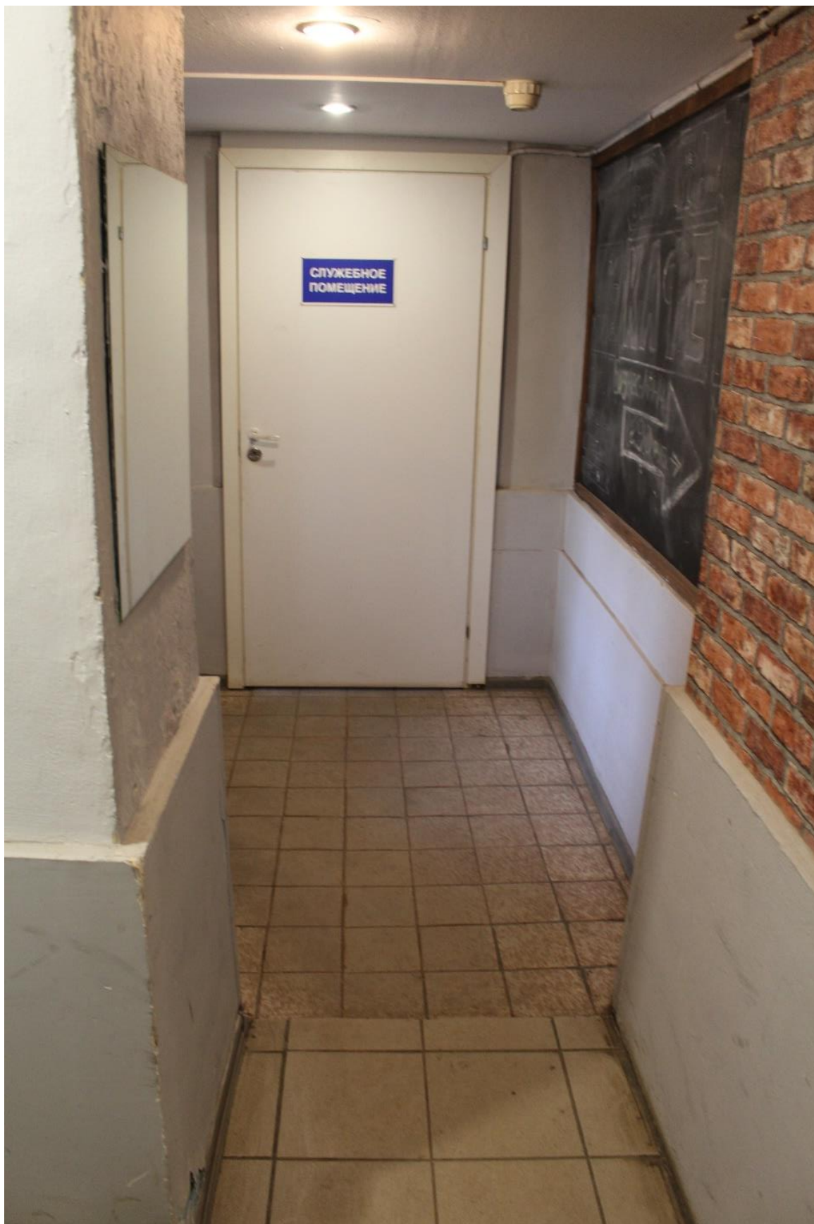
Фото 130. Внутренние помещения 2-го этажа выявленного объекта культурного наследия «Дом культуры текстильщиков (Дворец культуры им. Н.К. Крупской) (с флигелем)». Помещение 4-Н(53) пл. 4,3 кв. м.
