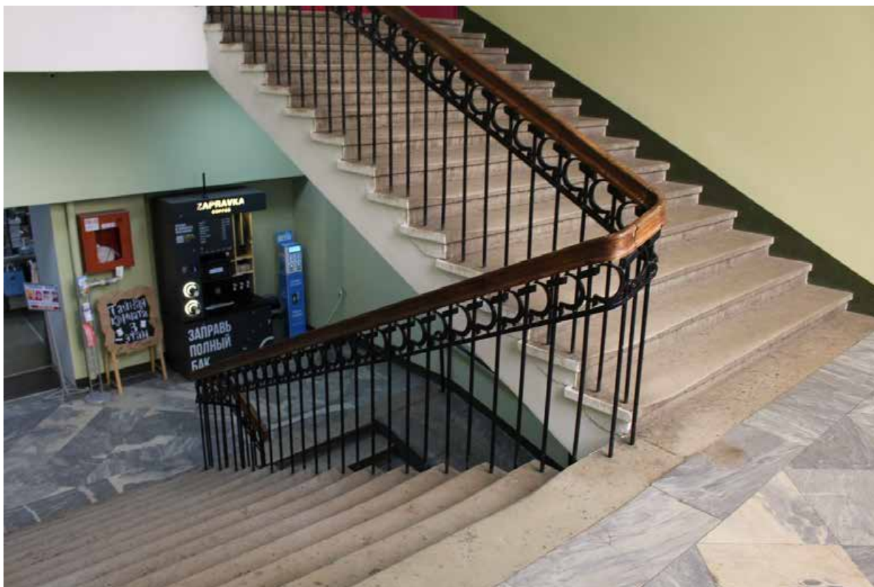
Фото 79. Внутренние помещения выявленного объекта культурного наследия «Дом культуры текстильщиков (Дворец культуры им. Н.К. Крупской) (с флигелем)». Восточная парадная лестница в уровне 1-го этажа (помещение 4-Н(81) пл. 58,5 кв. м).
