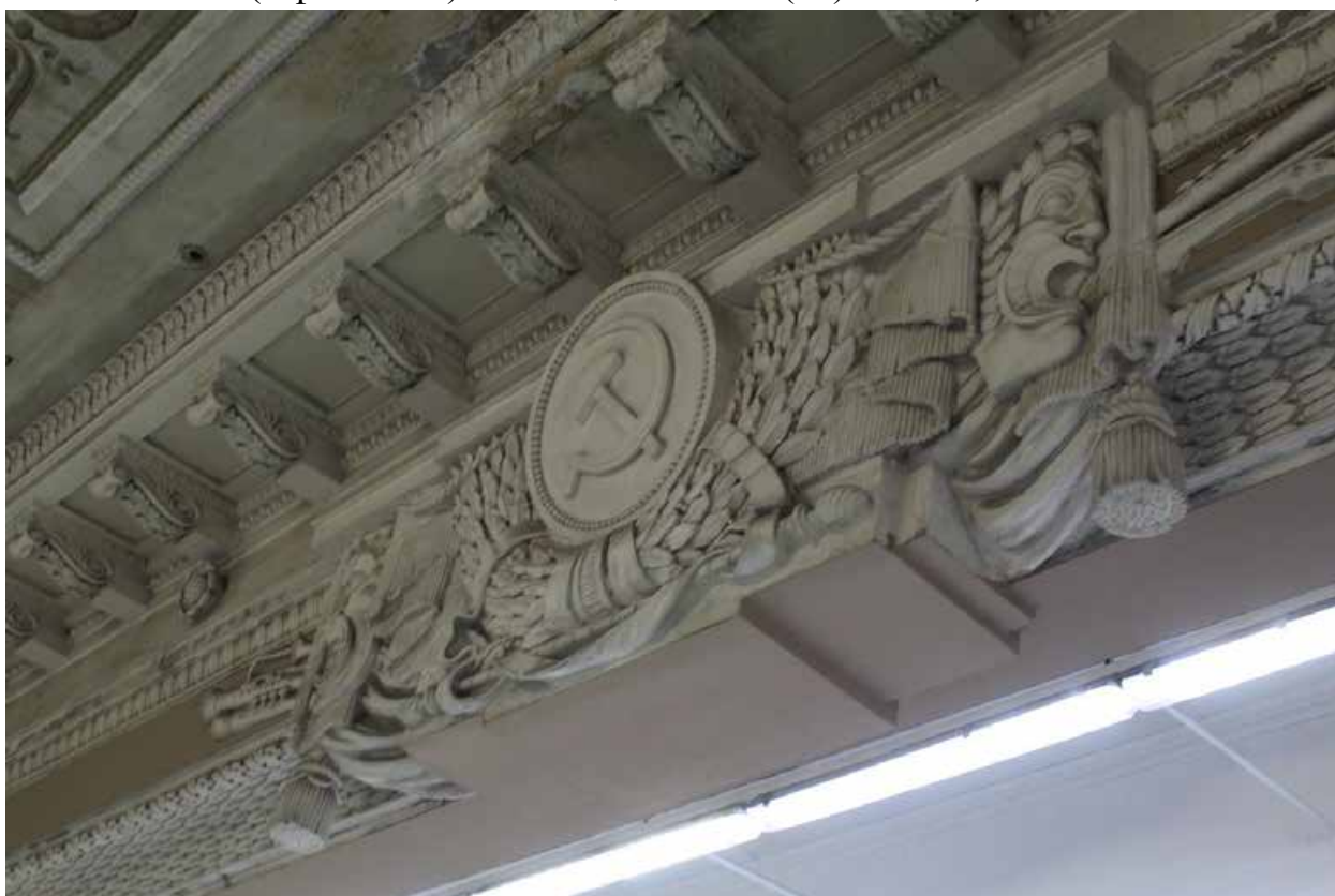
Фото 102. Внутренние помещения 2-го этажа выявленного объекта культурного наследия «Дом культуры текстильщиков (Дворец культуры им. Н.К. Крупской) (с флигелем)». Помещение 11-Н(66) пл. 297,1 кв. м.
