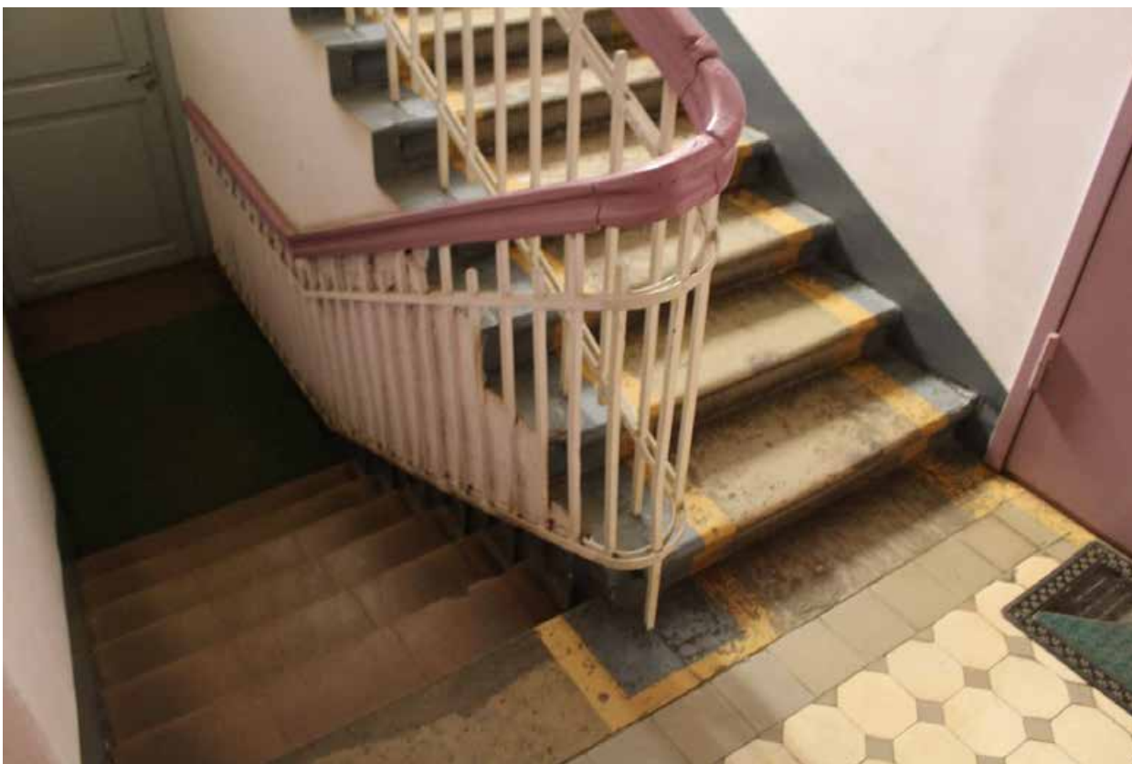
Фото 123. Внутренние помещения выявленного объекта культурного наследия «Дом культуры текстильщиков (Дворец культуры им. Н.К. Крупской) (с флигелем)». Восточная служебная лестница Дома культуры в уровне 1-го этажа (помещение 4-Н(85) пл. 12,4 кв. м).
