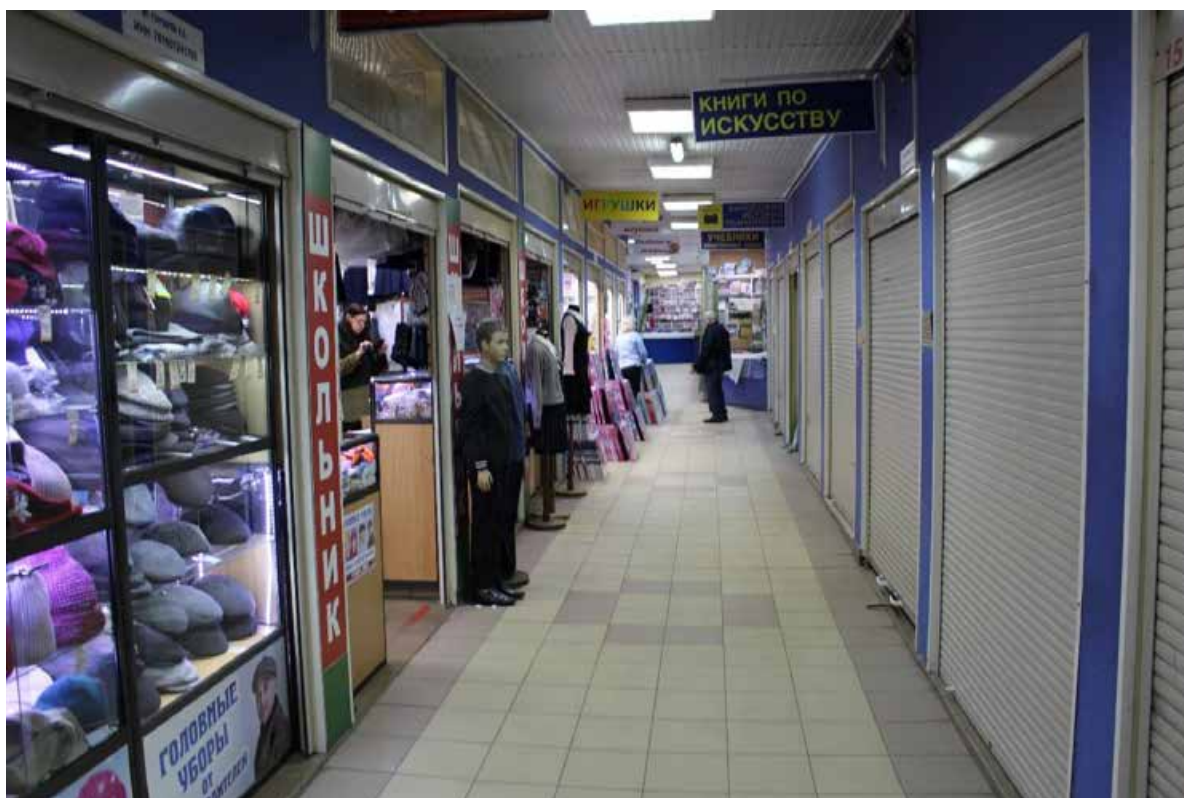
Фото 77. Внутренние помещения 1-го этажа выявленного объекта культурного наследия «Дом культуры текстильщиков (Дворец культуры им. Н.К. Крупской) (с флигелем)». Помещения поздней пристройки, не поставленные на технический и кадастровый учет.
