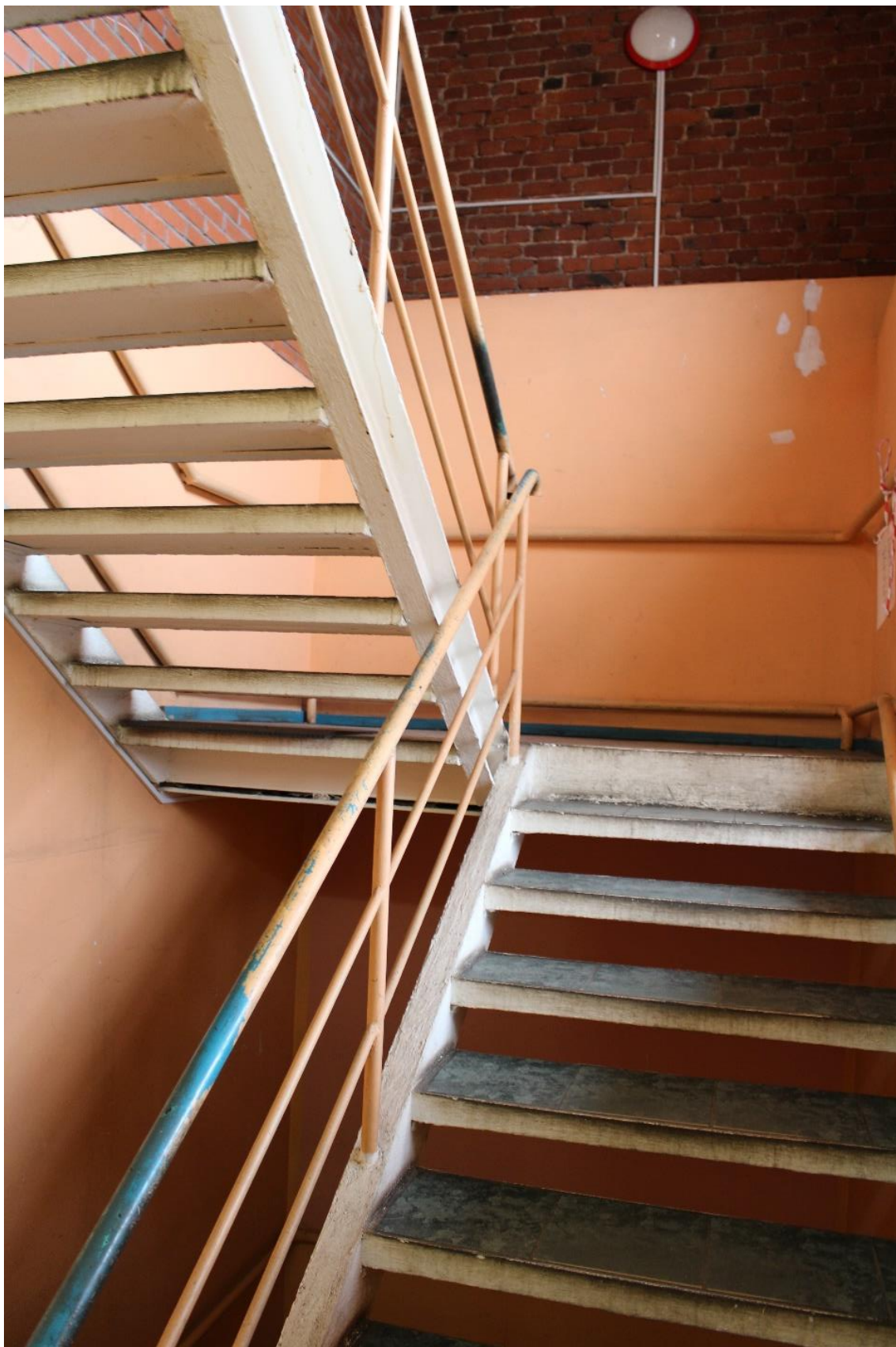
Фото 53. Внутренние помещения выявленного объекта культурного наследия «Дом культуры текстильщиков (Дворец культуры им. Н.К. Крупской) (с флигелем)». Служебная лестница в уровне 2-го - технического этажа (помещение 11-Н(83) пл. 12,6 кв. м).
