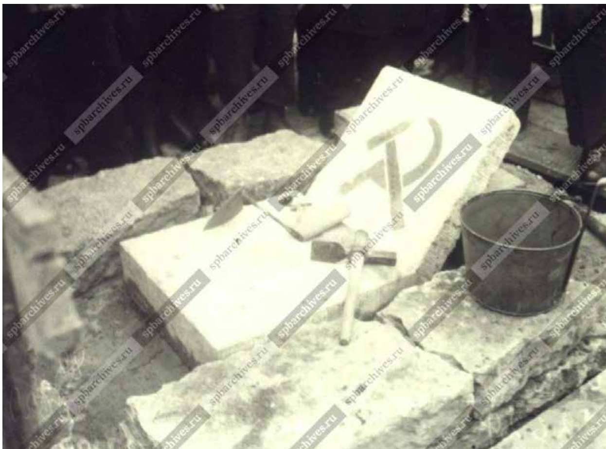
Илл. 44. Укладка закладного камня в фундамент клуба «Рабочий» Союза текстильщиков на проспекте Смоленского, 67. 1927 г. (источник: ЦГАКФФД СПб. Фотодокументы. Опись 1ВР-26. Ед.хр.34309).
