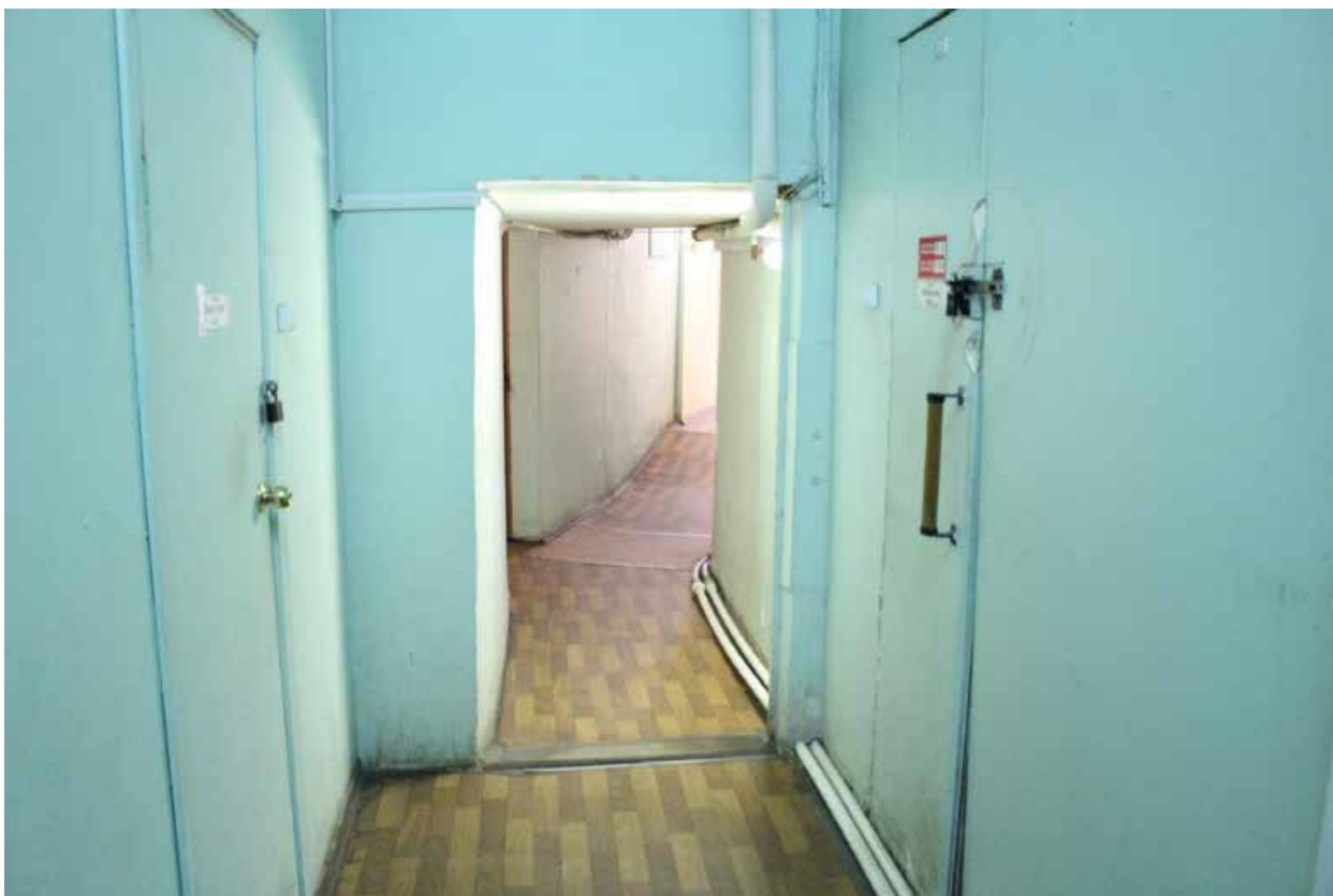
Фото 56. Внутренние помещения 1-го этажа выявленного объекта культурного наследия «Дом культуры текстильщиков (Дворец культуры им. Н.К. Крупской) (с флигелем)». Помещение 4-Н(18) пл. 17,4 кв. м
