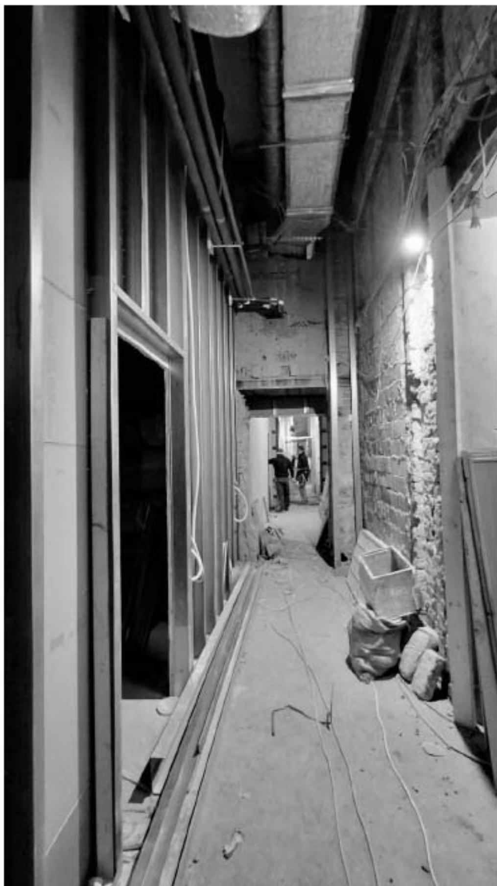
12. Фрагмент интеръера коридора (помещение 1.15);
