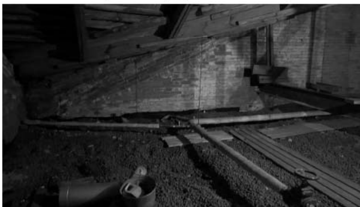
2. Фрагмент интерьера технического этажа;
