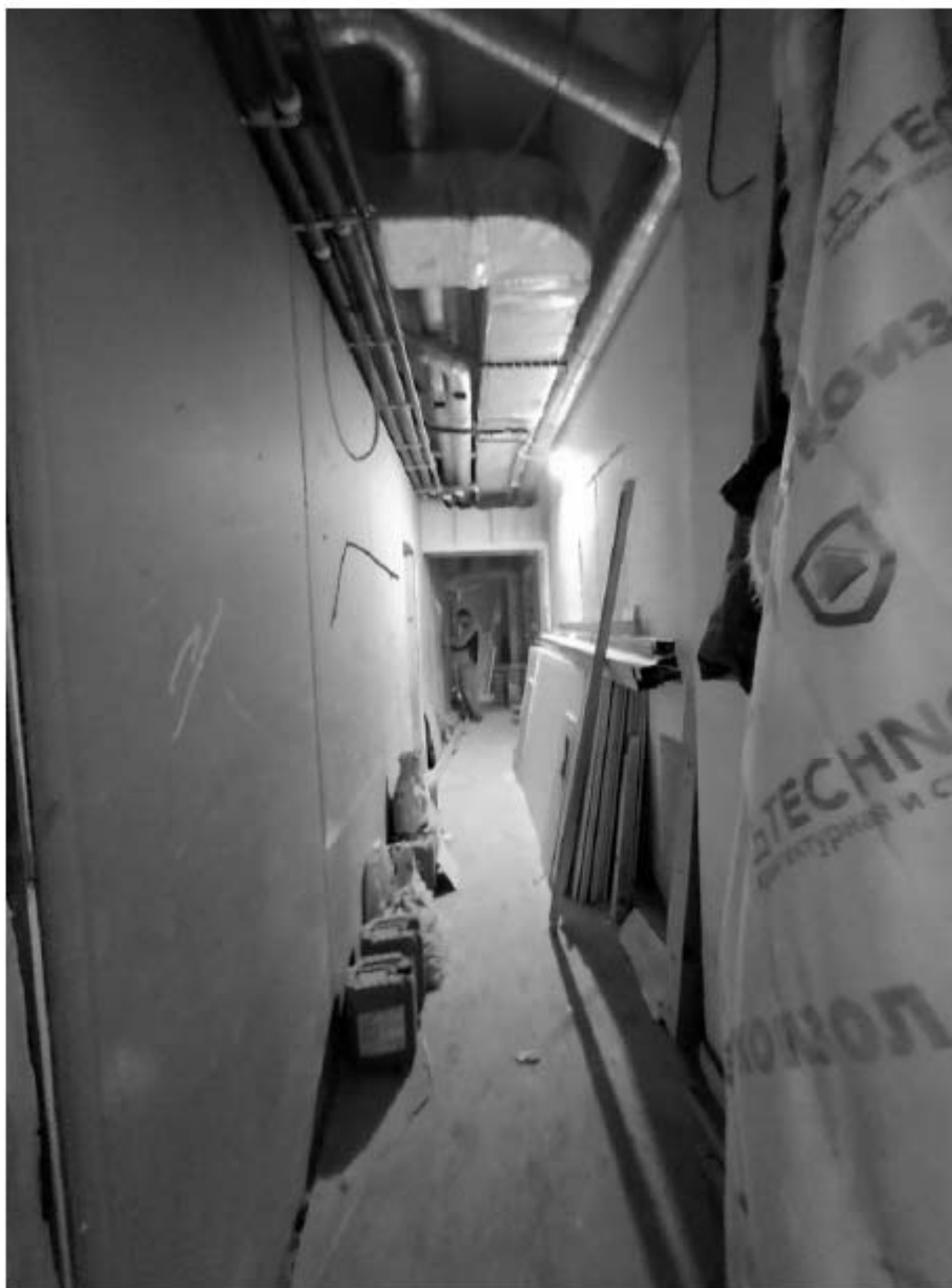
2. Фрагмент интерьера коридора (помещение 3.17);
