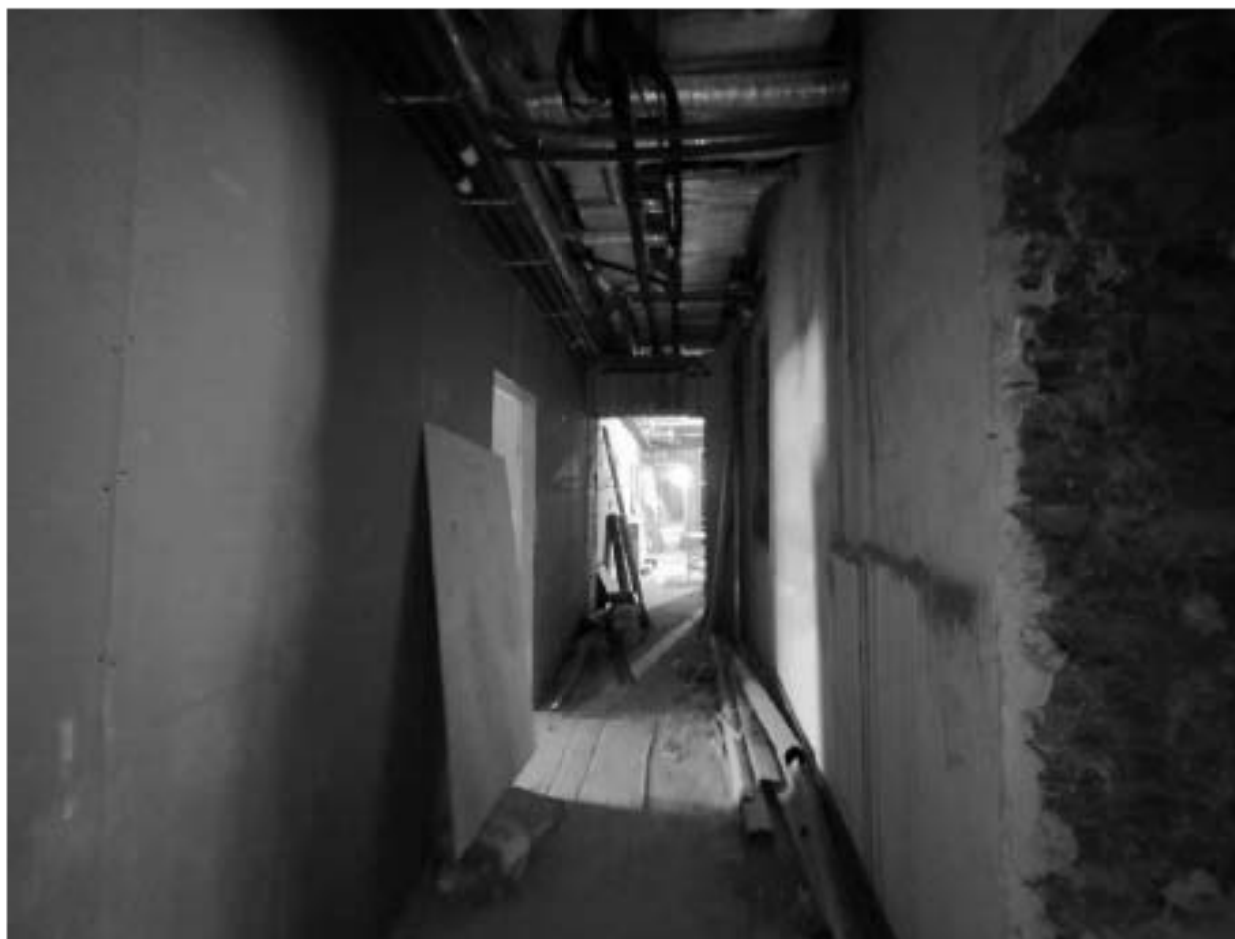
37. Фрагмент интерьера коридора (помещение 3.5);
