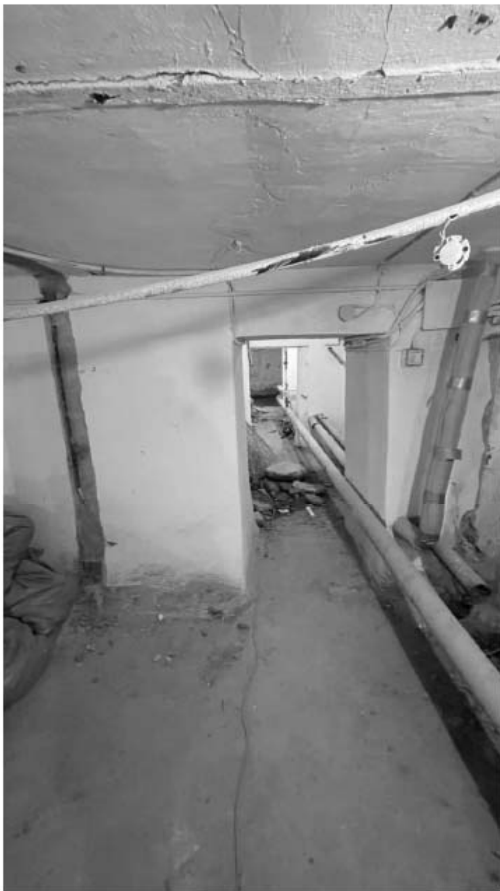
5. Фрагмент интеръера коридора (помещение 0.6);
