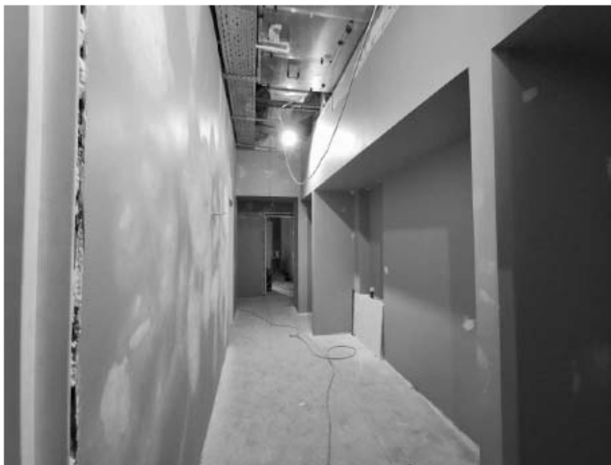
16. Фрагмент интерьера коридора (помещение 2.13);
