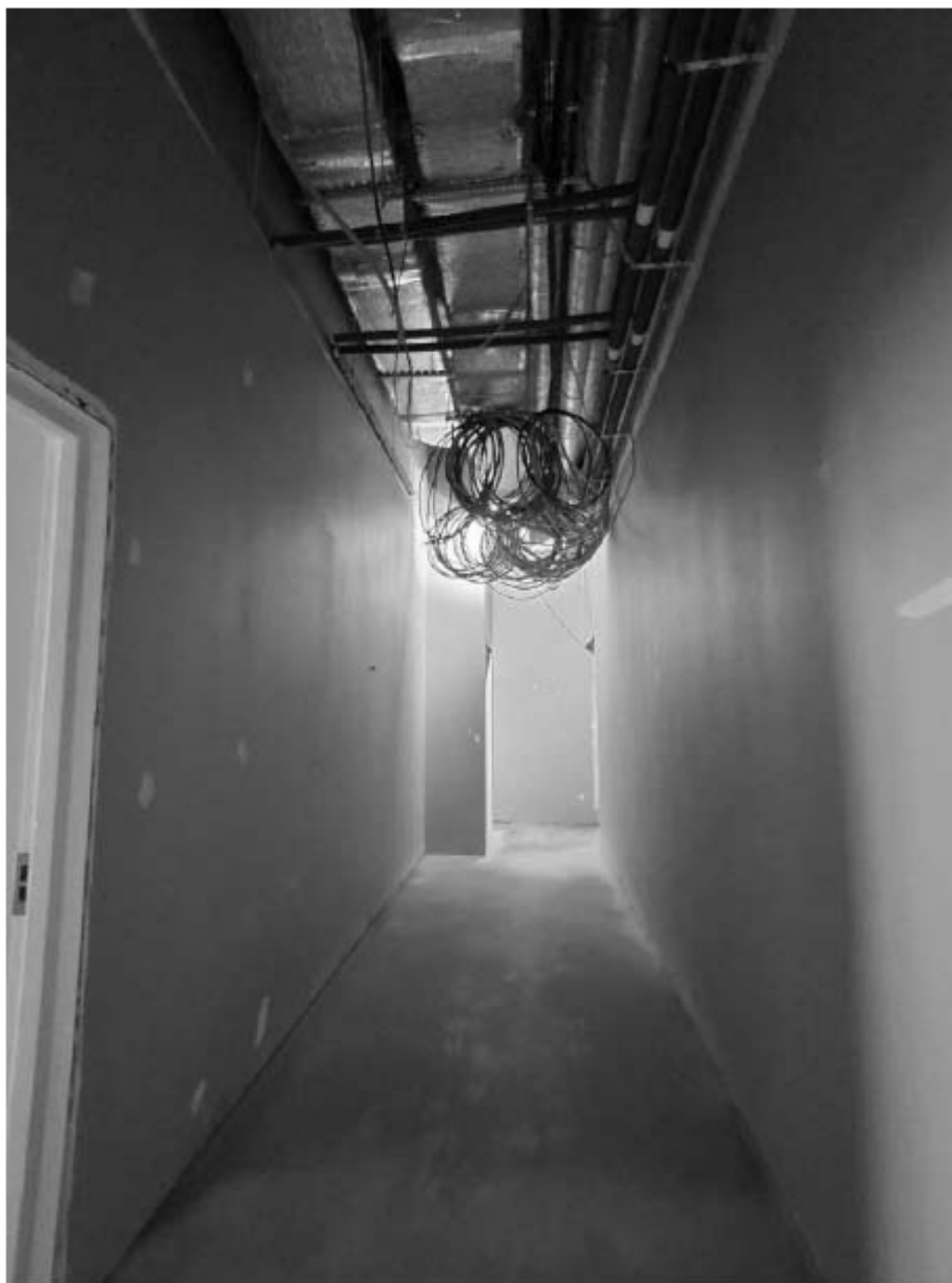
8. Фрагмент интерьера коридора (помещение 2.23);
