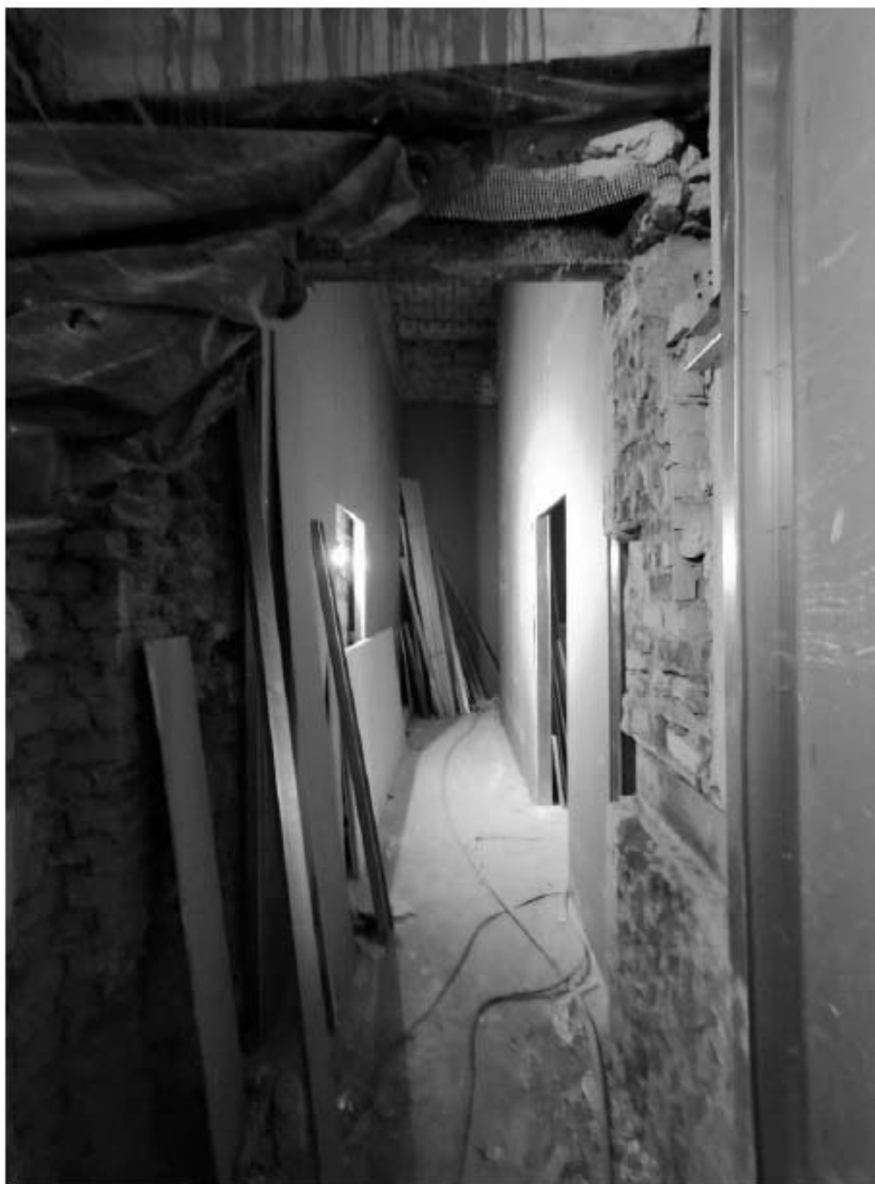
31. Фрагмент интерьера коридора (помещение 1.18);
