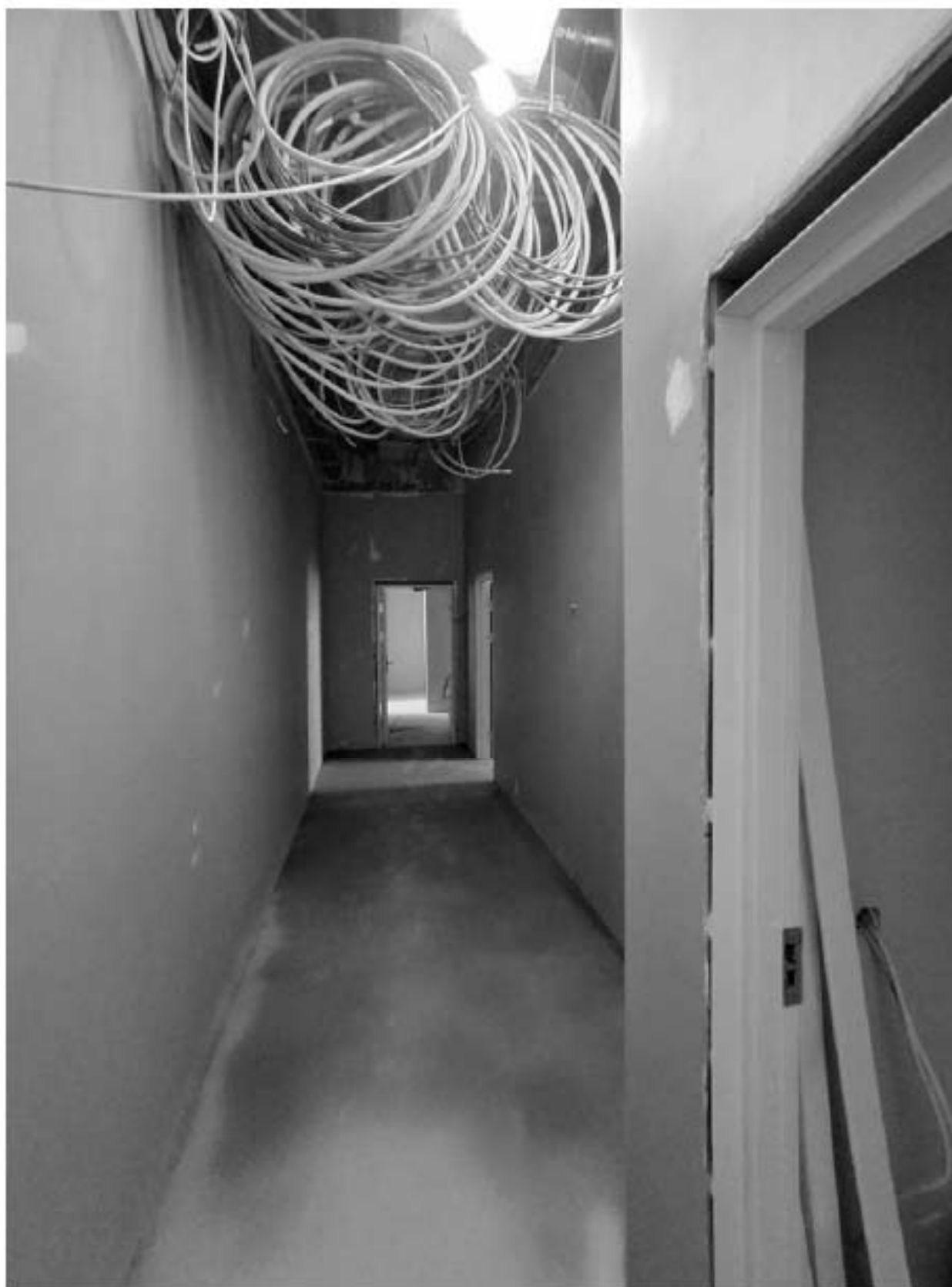
7. Фрагмент интерьера коридора (помещение 2.23);
