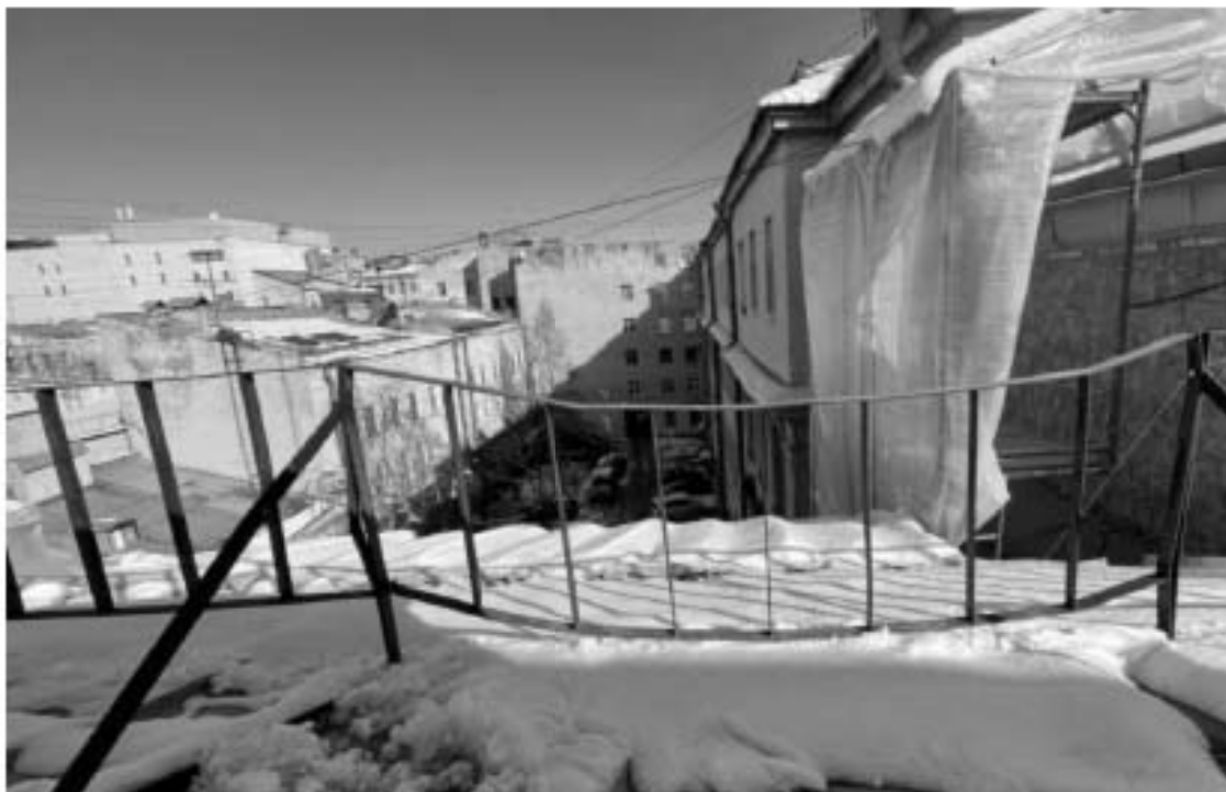
5. Вид на крышу
