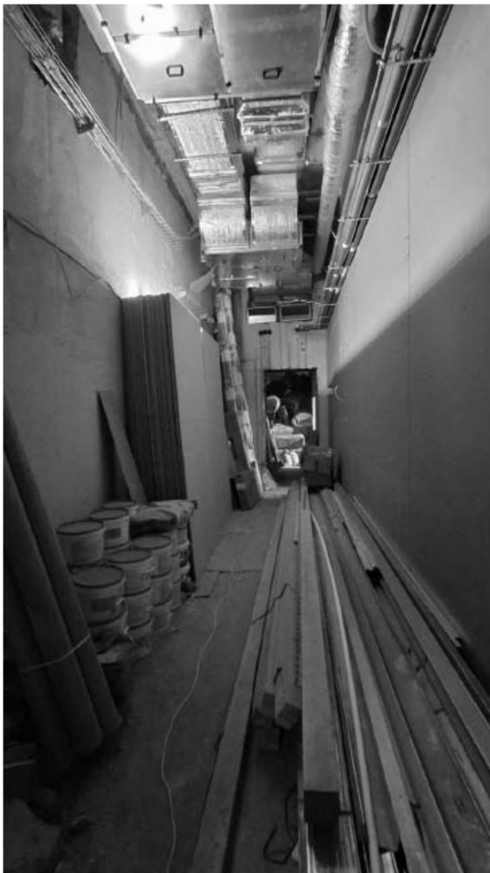
14. Фрагмент интеръера коридора (помещение 1.13);
