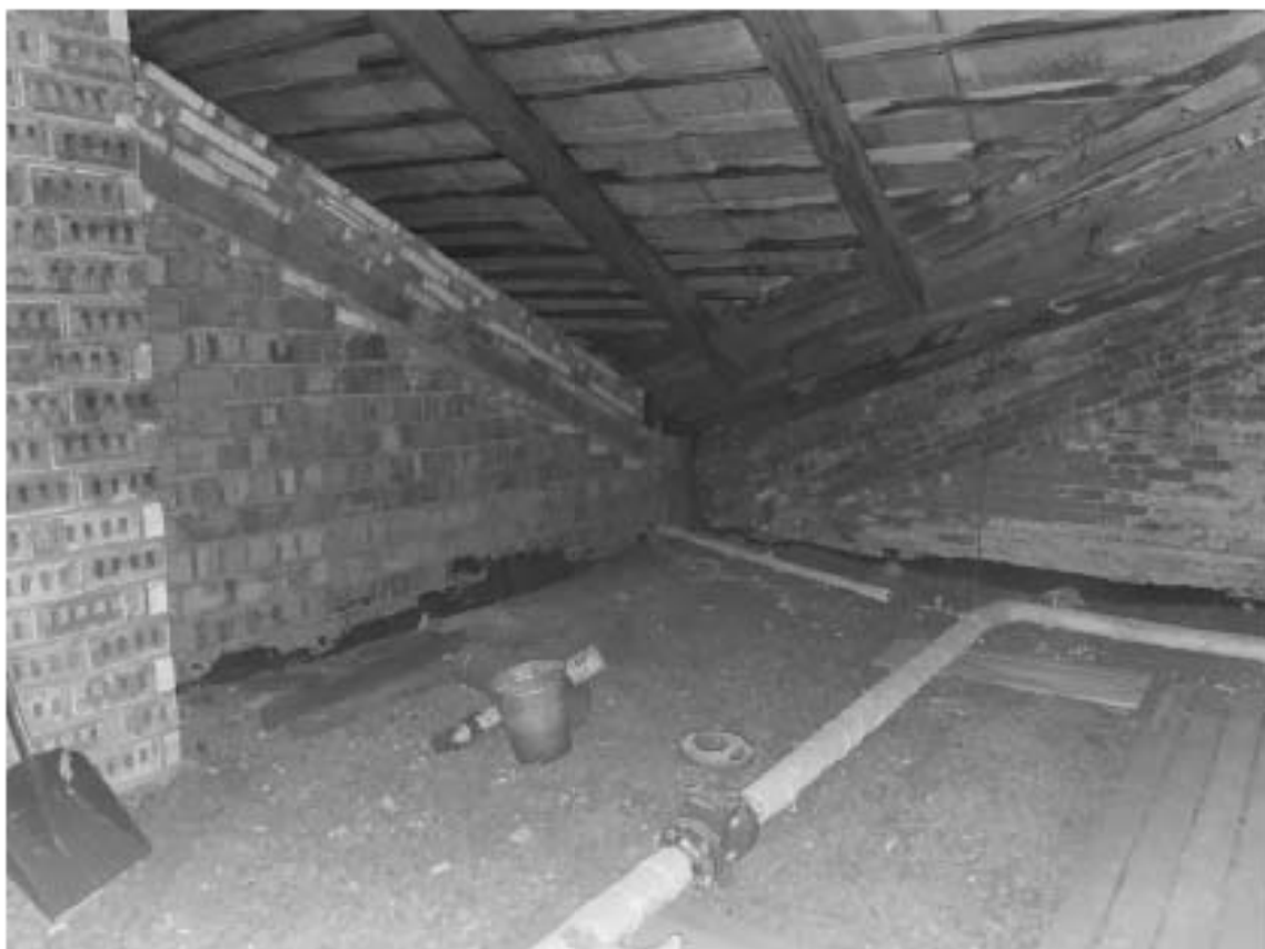
3. Фрагмент интерьера технического этажа;
