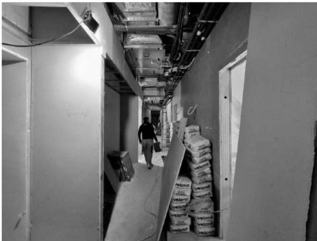
10. Фрагмент интерьера коридора (помещение 3.14);
