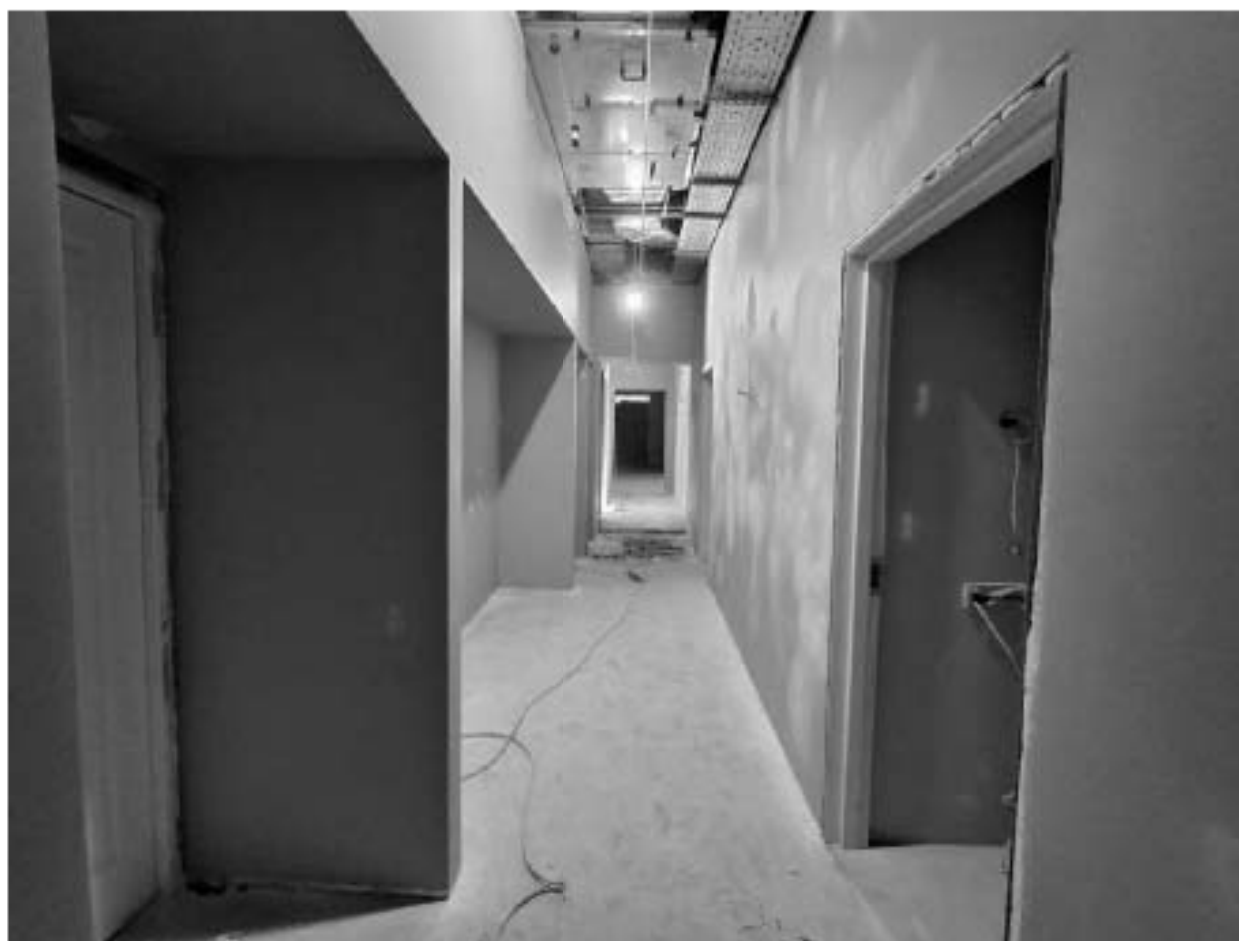
15. Фрагмент интерьера коридора (помещение 2.13);
