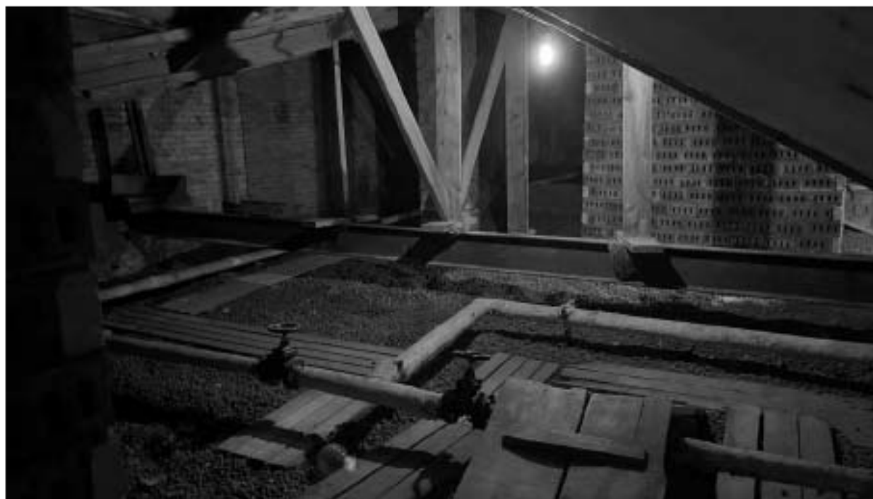
1. Фрагмент интерьера технического этажа;
