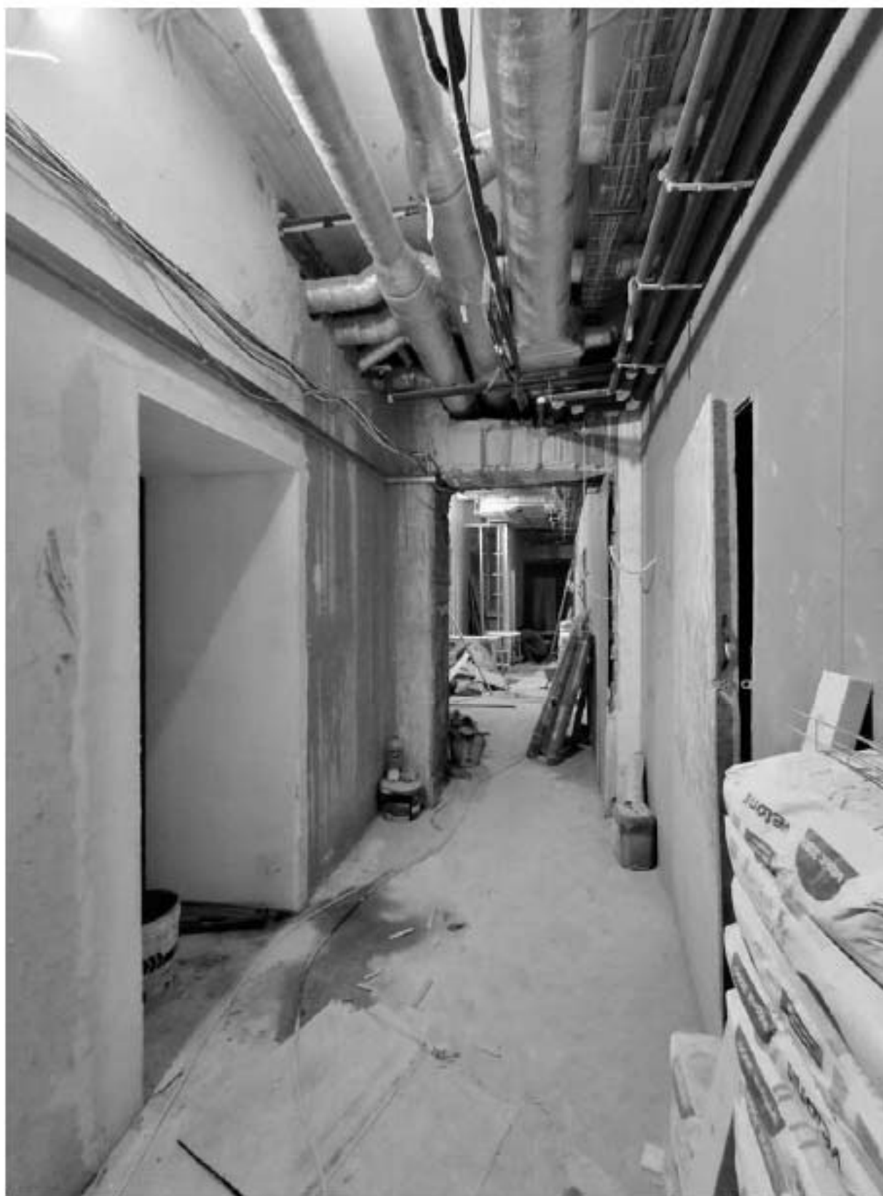
20. Фрагмент интерьера коридора (помещение 3.12);
