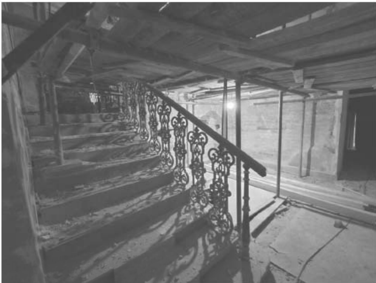
11. Вид на парадную лестницу Л-1 (помещение №1.3);
