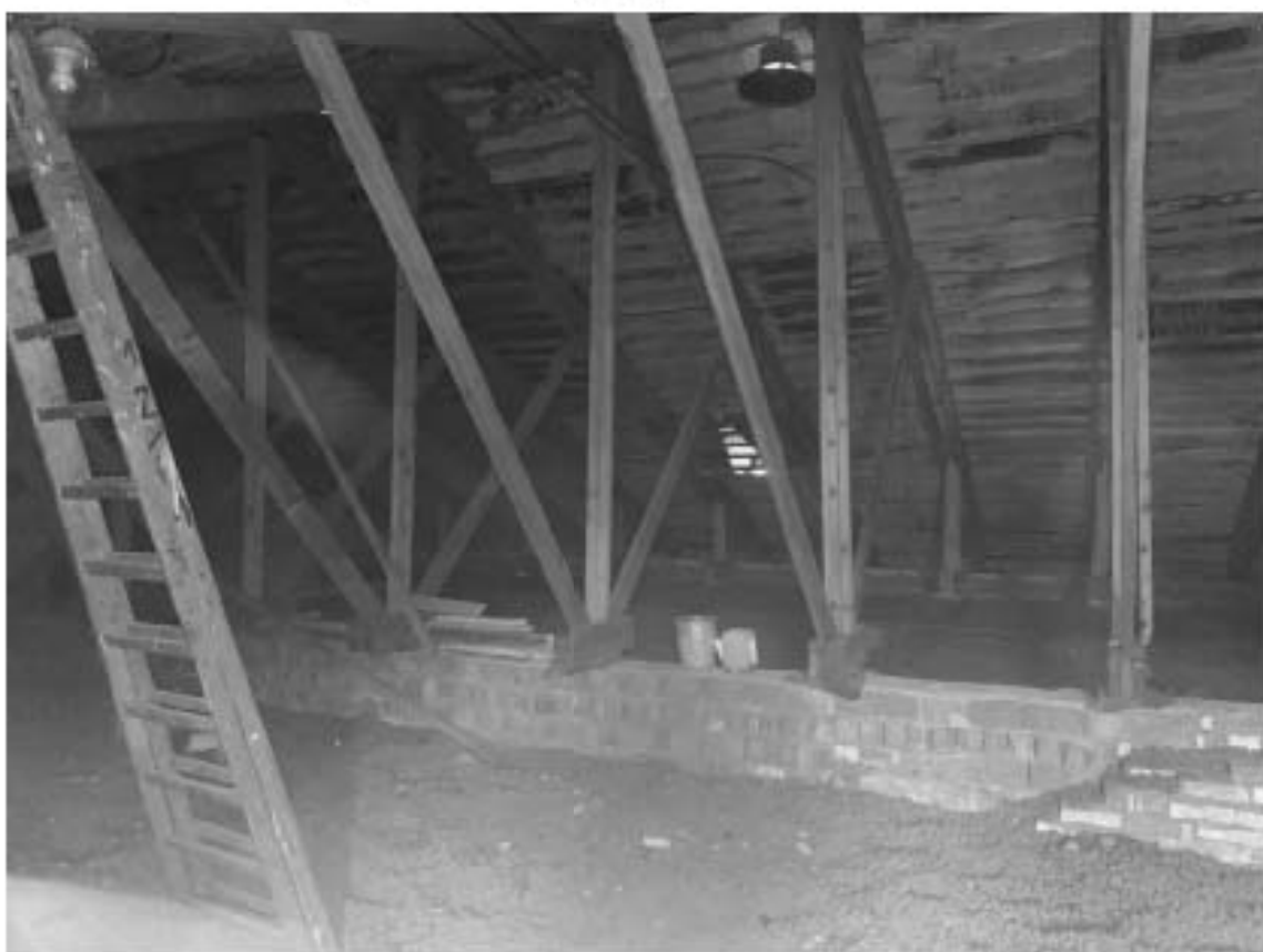
4. Фрагмент интерьера технического этажа;
