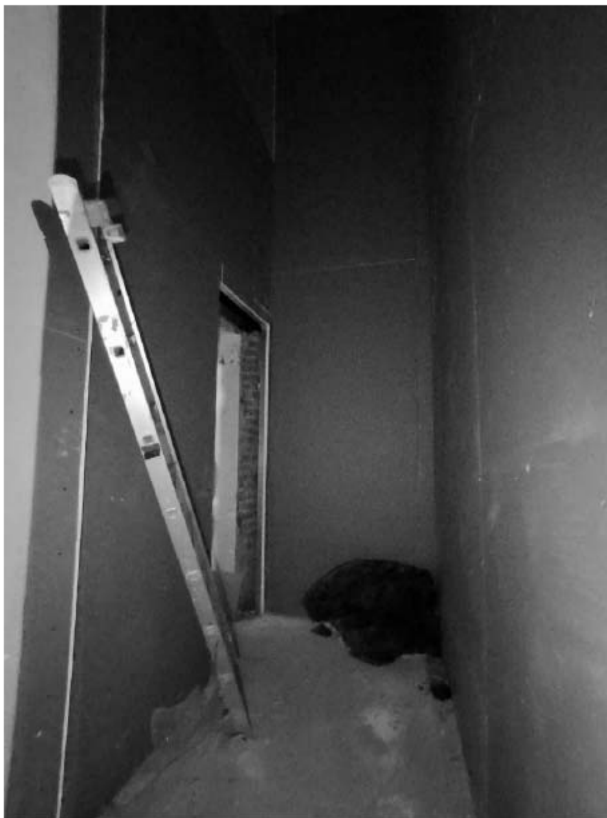
33. Фрагмент интерьера коридора (помещение 1.18);
