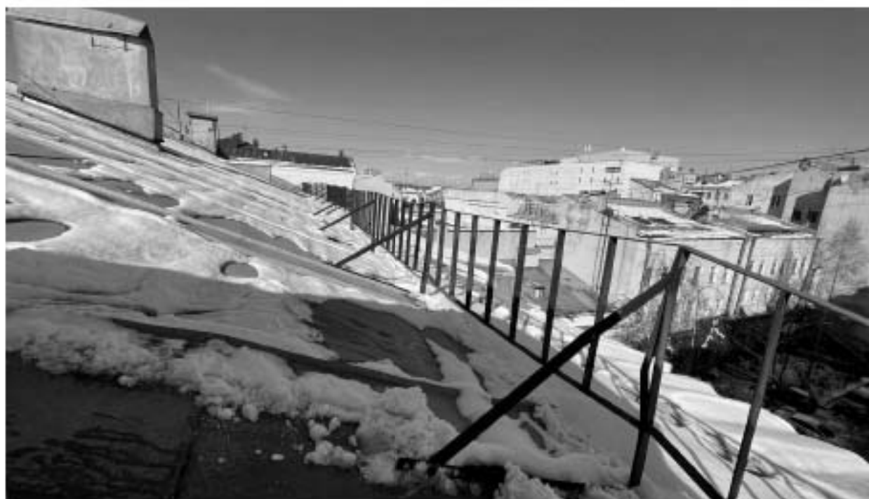
6. Вид на крышу
