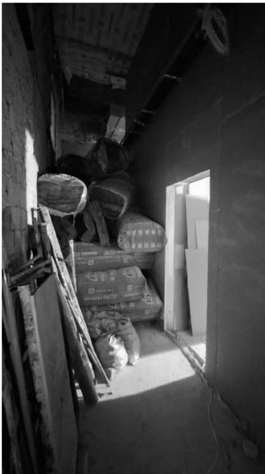
16. Фрагмент интерьера коридора (помещение 1.13);
