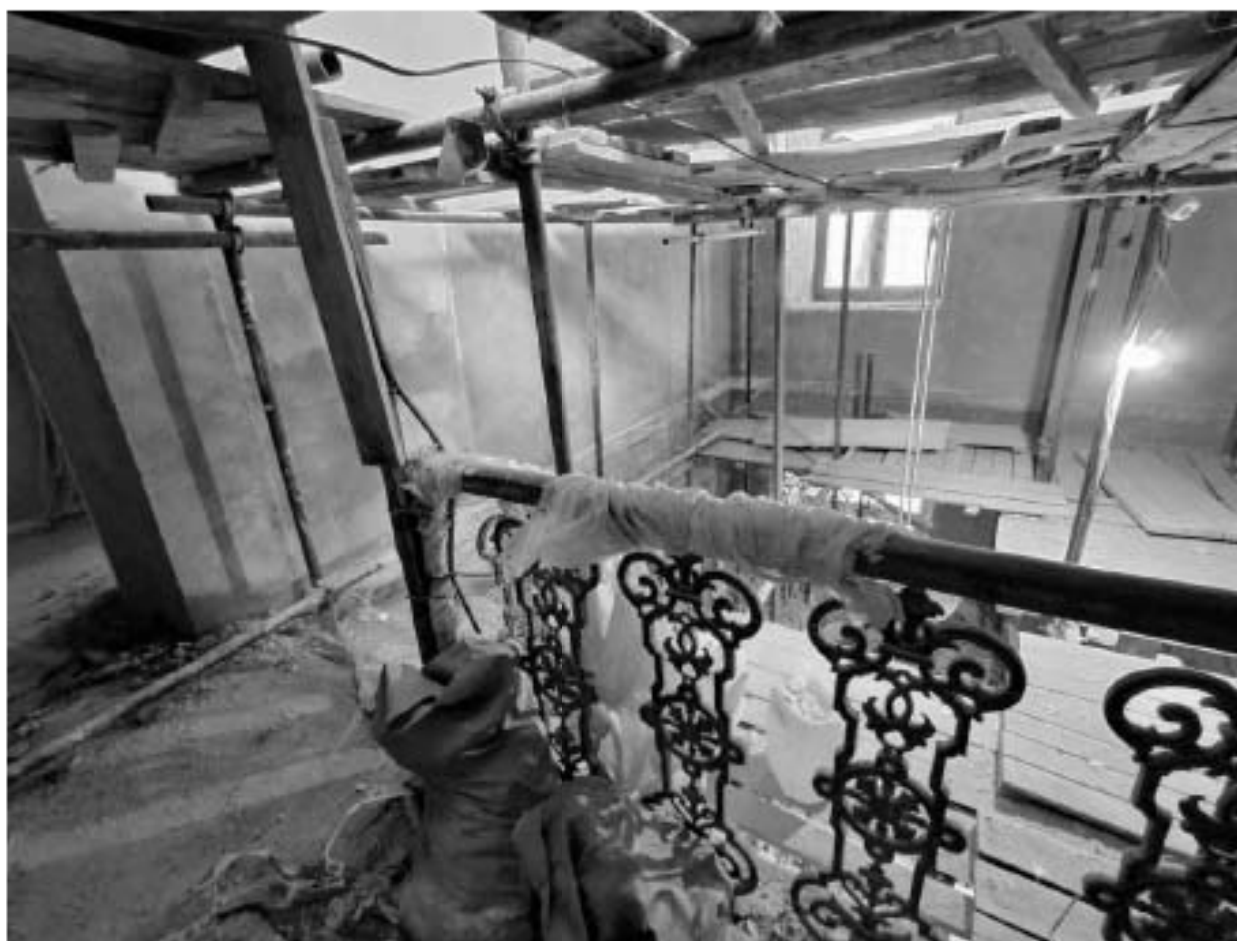
45. Вид парадной лестницы Л-1.
