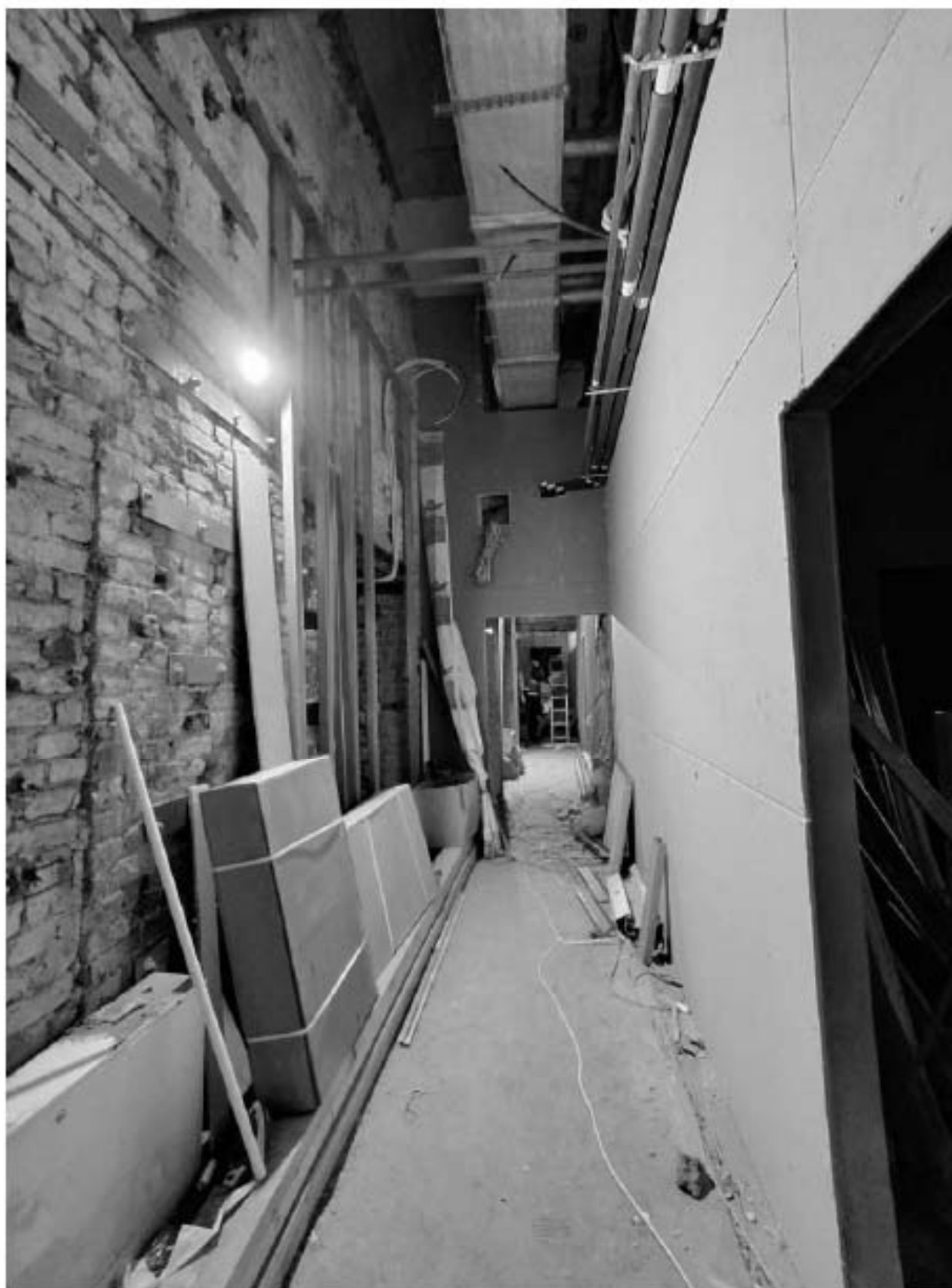
26. Фрагмент интерьера коридора (помещение 1.17);
