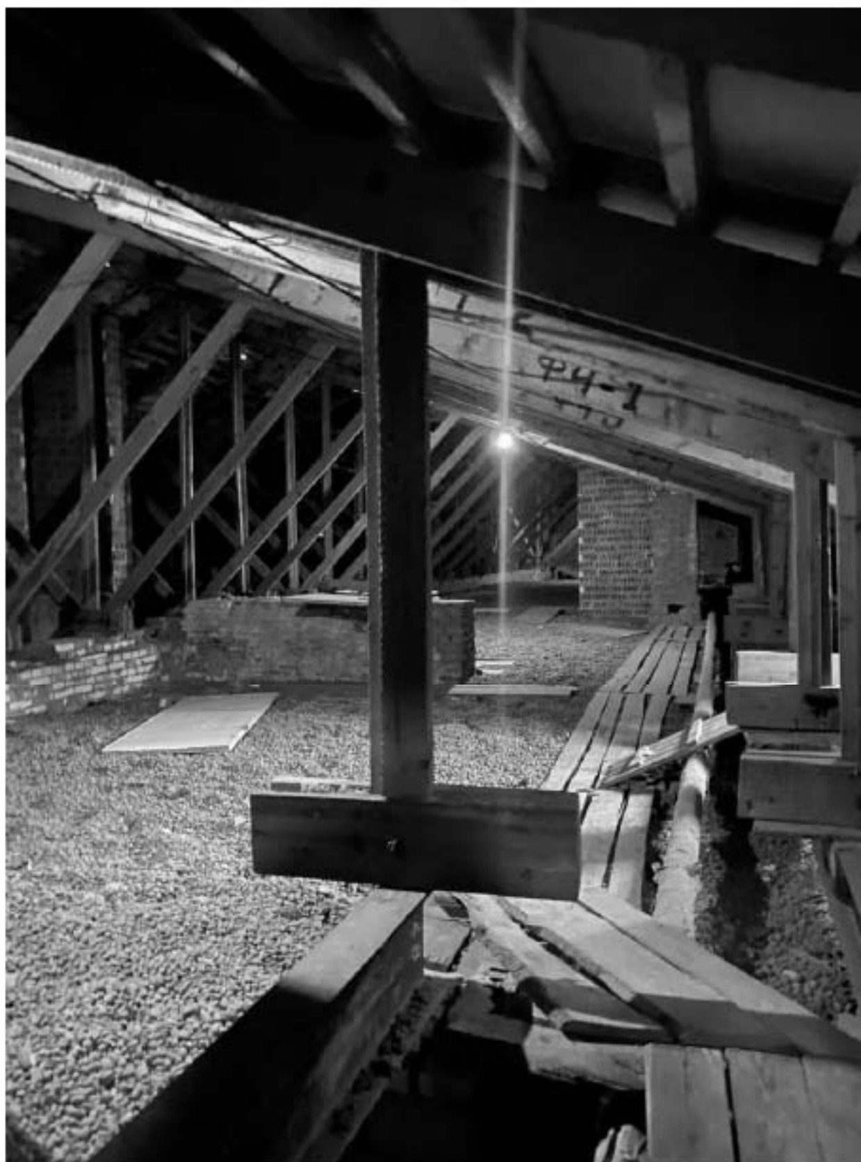
7. Фрагмент интерьера технического этажа;
