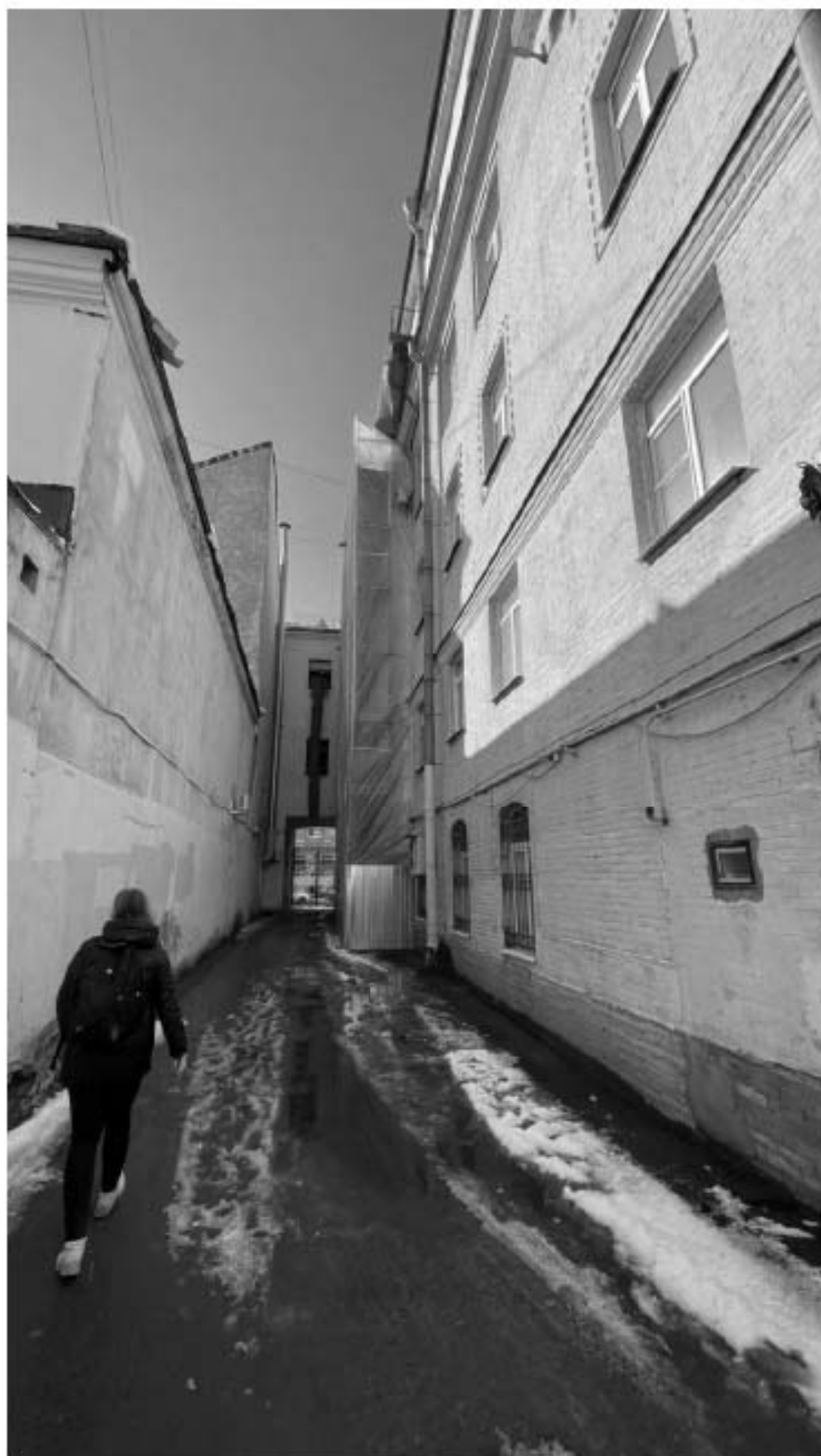
3. Вид на дворовой фасад объекта культурного наследия регионального значения «Особняк А.П. Шувалова (Е.А. Воронцовой-Дашковой)»;
