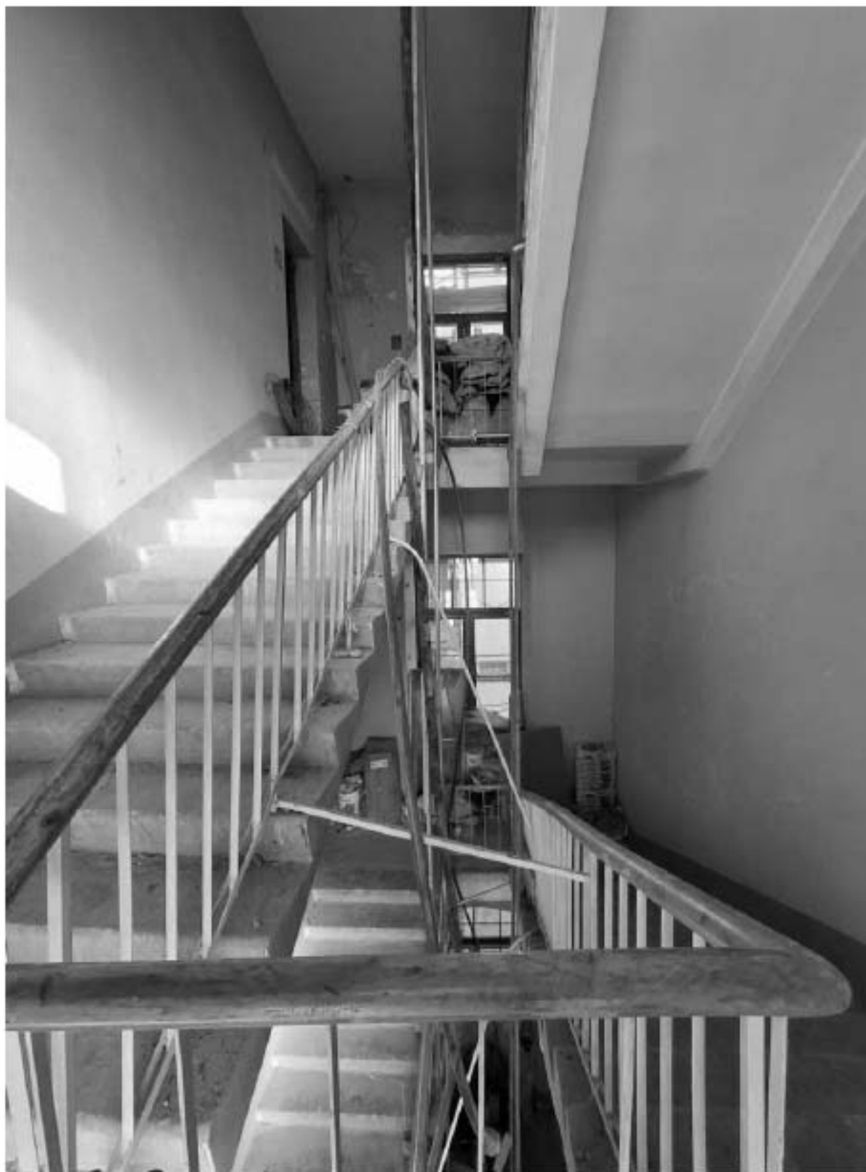
1. Вид лестницы Л-2;
