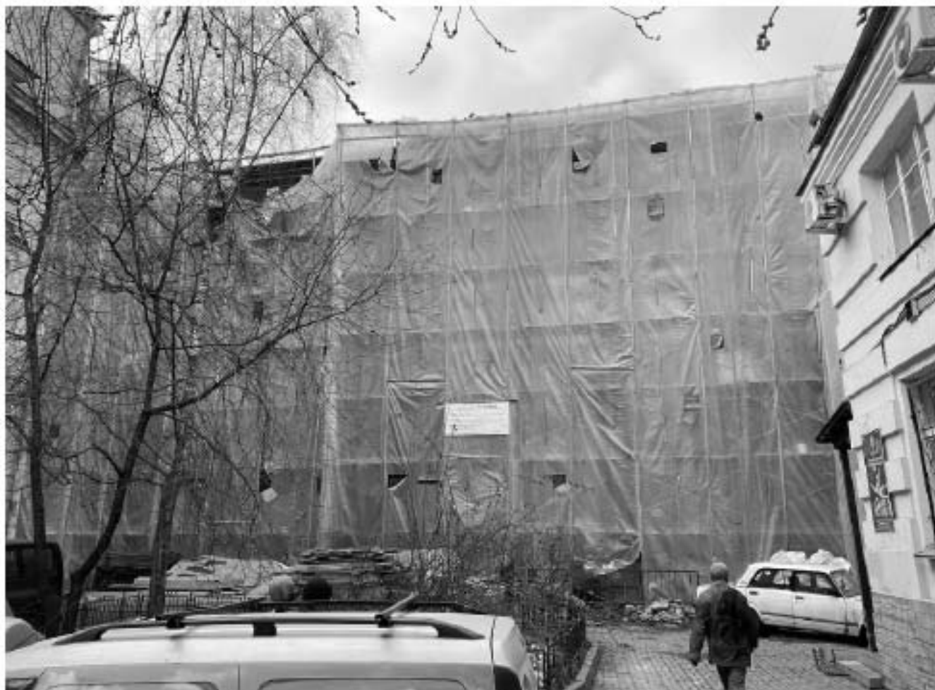
4. Вид на дворовой фасад объекта культурного наследия регионального значения «Особняк А.П. Шувалова (Е.А. Воронцовой-Дашковой)»;
