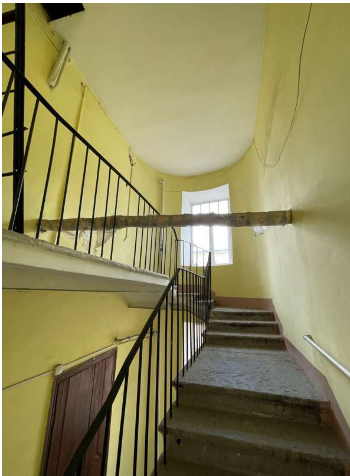
96. Фрагмент интерьера лестницы 2ЛК
