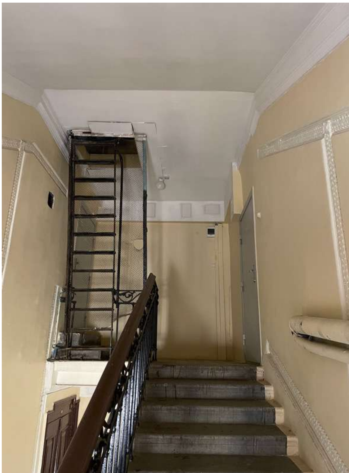
50. Фрагмент интерьера лестницы 4ЛК
