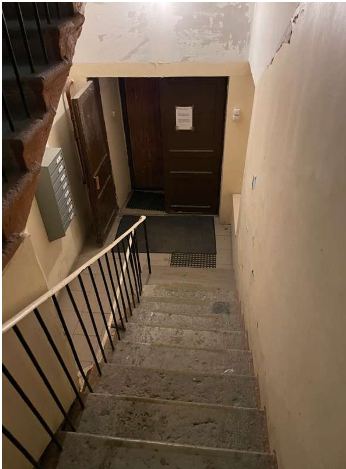
47. Фрагмент интерьера лестницы 5ЛК
