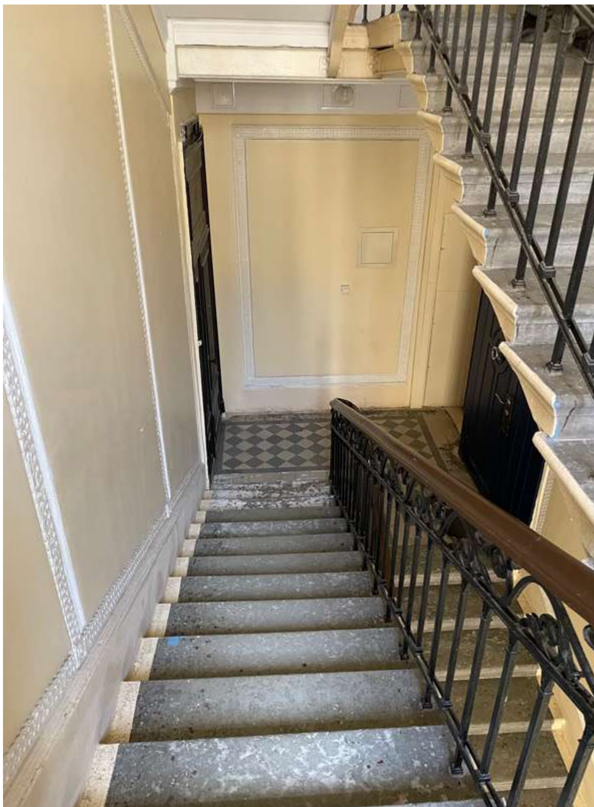
56. Фрагмент интерьера лестницы 4ЛК
