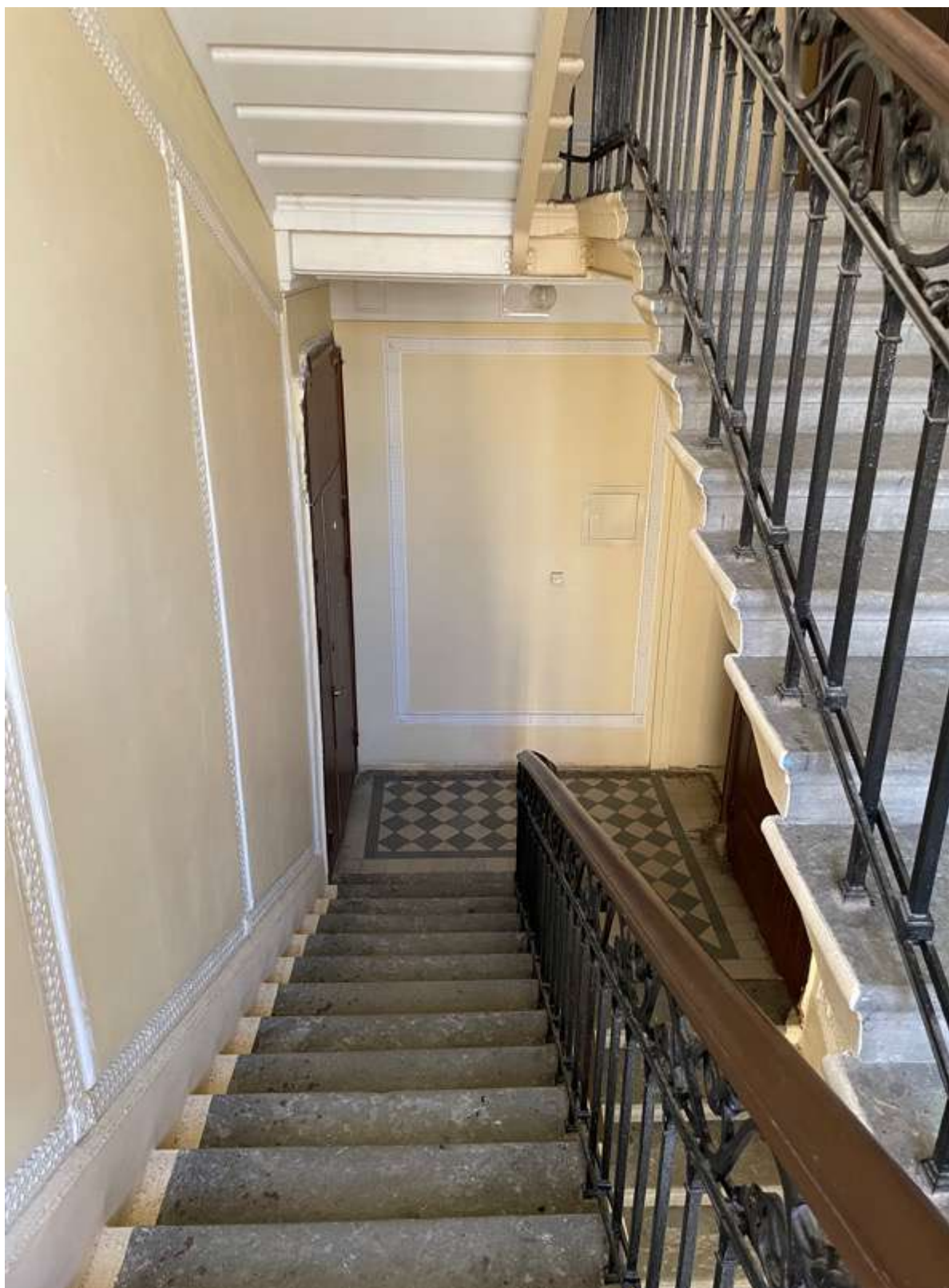
53. Фрагмент интерьера лестницы 4ЛК
