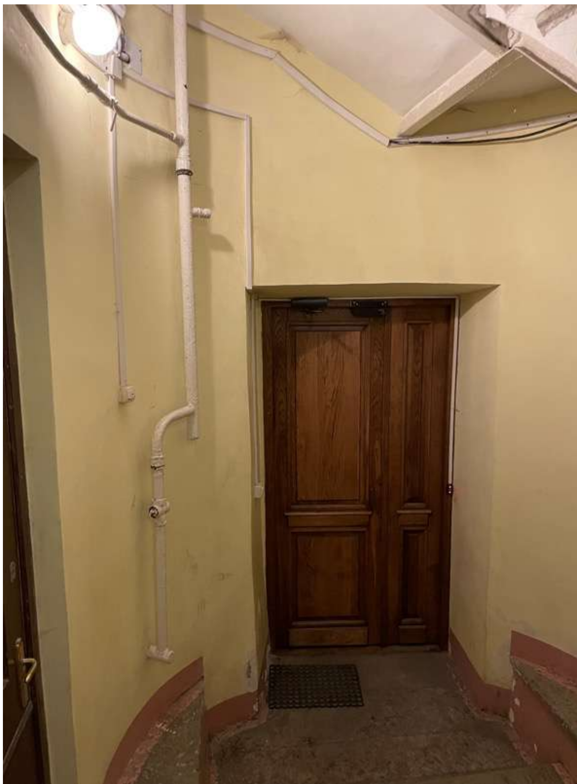
88. Фрагмент интерьера лестницы 2ЛК
