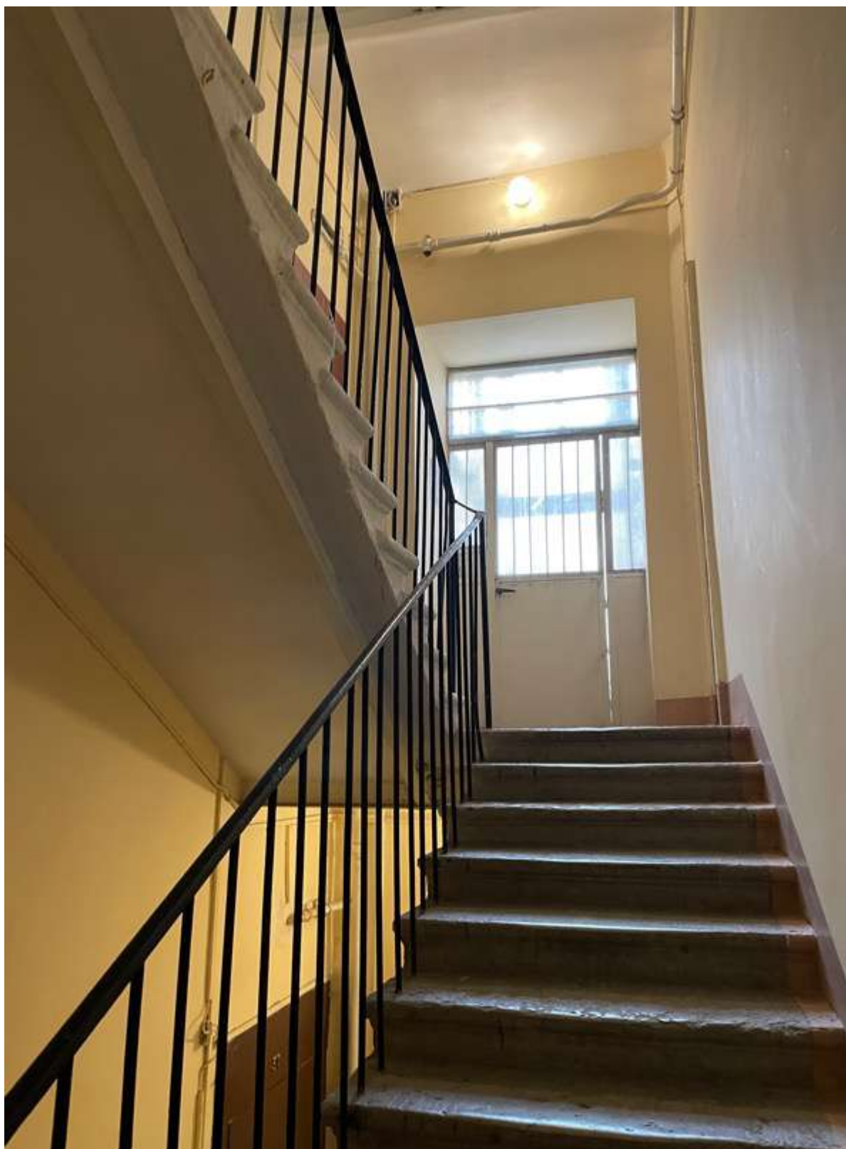
69. Фрагмент интерьера лестницы ЗЛК
