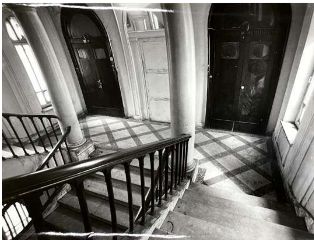
159. Парадная лестница. Лестничная площадка. 1986 г. Архив КГИОП 57300/1-Н
