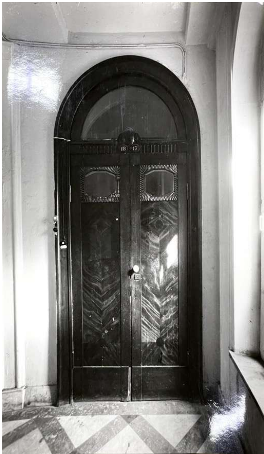
162. Вид входной двери с лестничной площадки. 1986 г. Архив КГИОП 57297/1-Н
