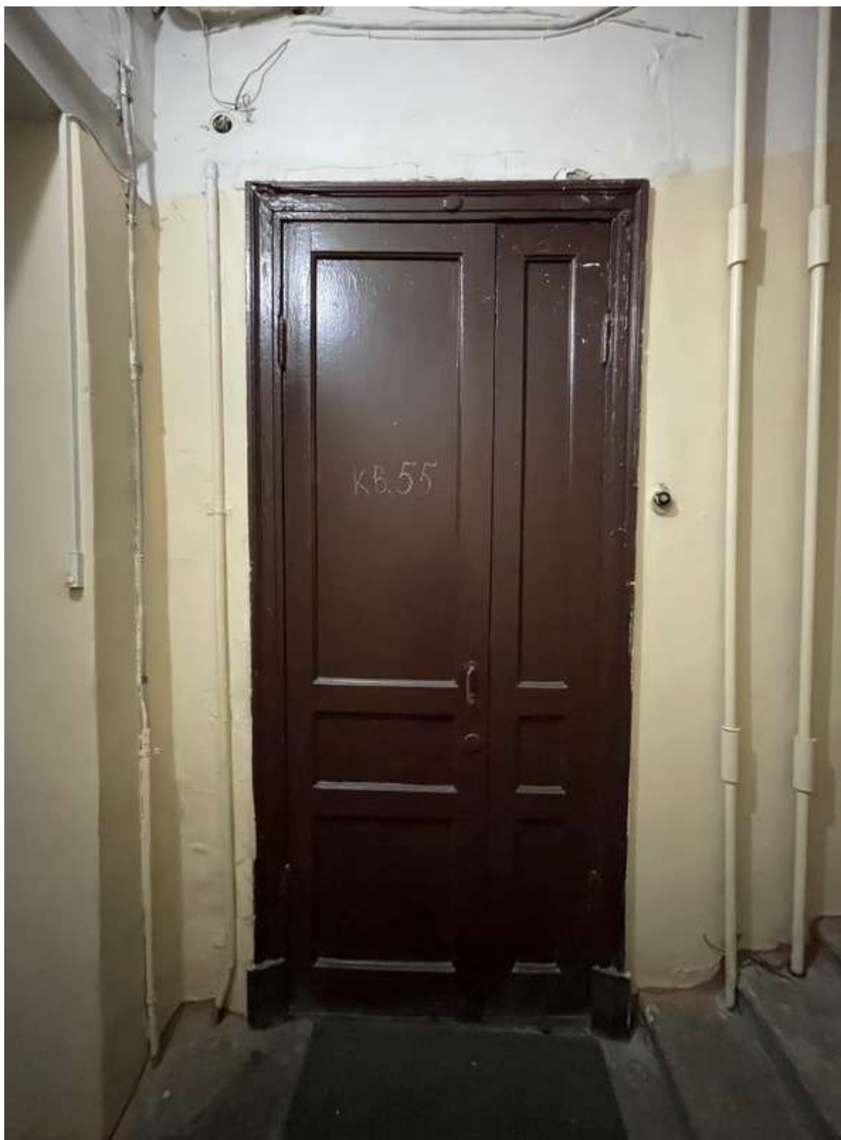
38. Фрагмент интерьера лестницы 5ЛК
