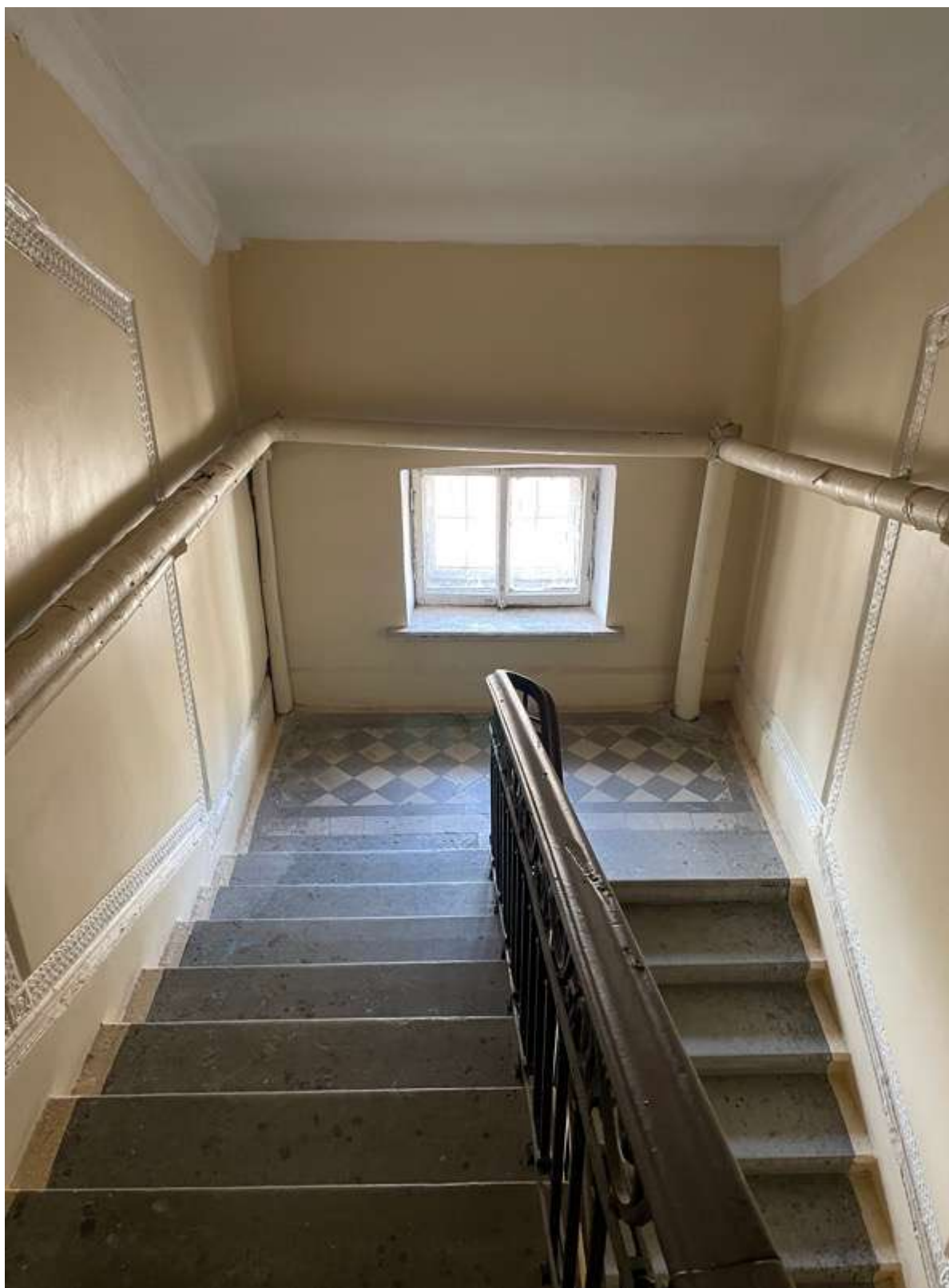
49. Фрагмент интерьера лестницы 4ЛК
