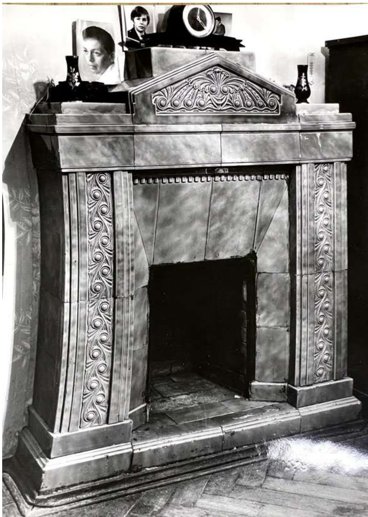
166. Камин в квартире 18. 1986 г. Архив КГИОП 57276/1-Н
