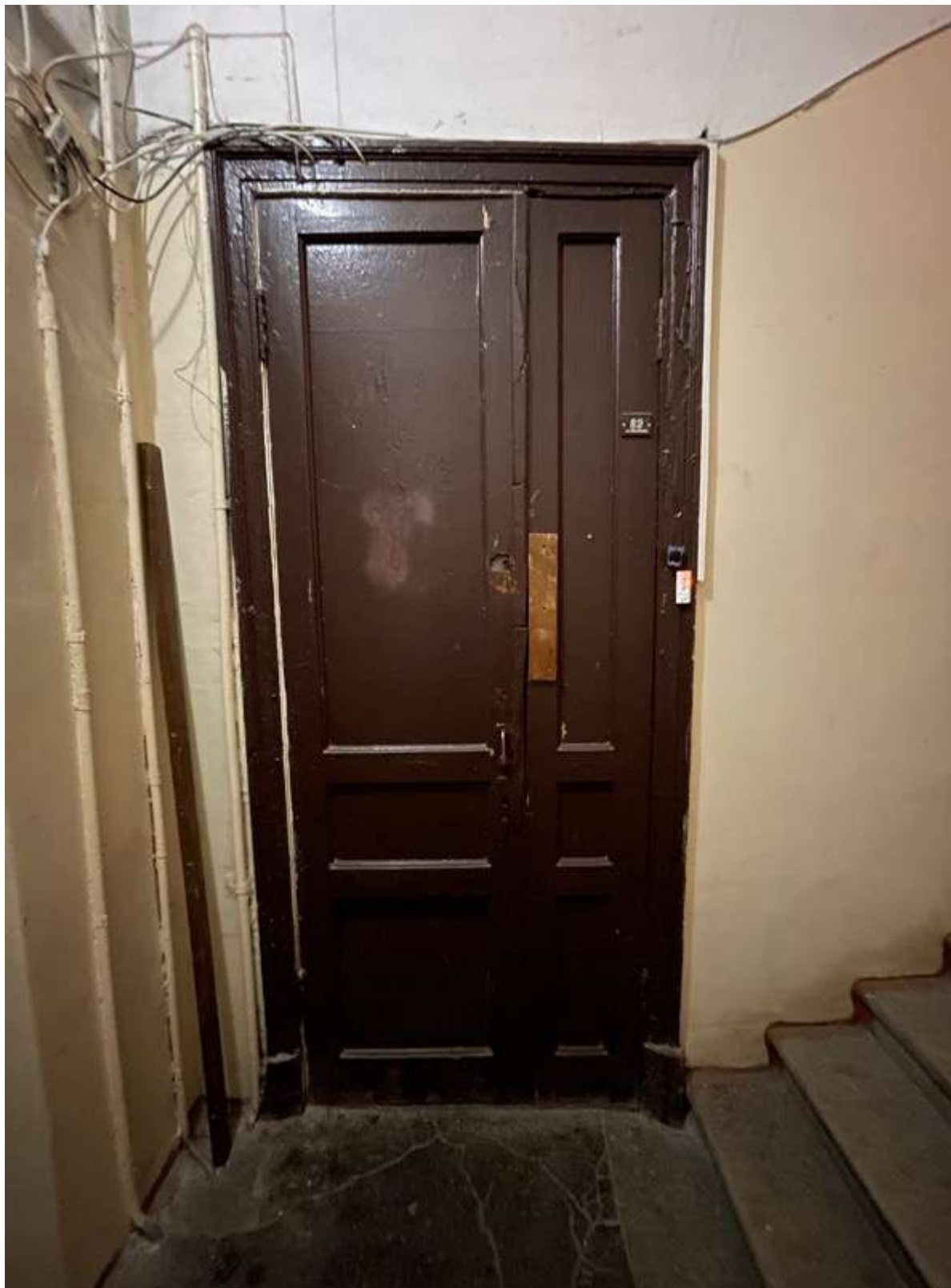
45. Фрагмент интерьера лестницы 5ЛК
