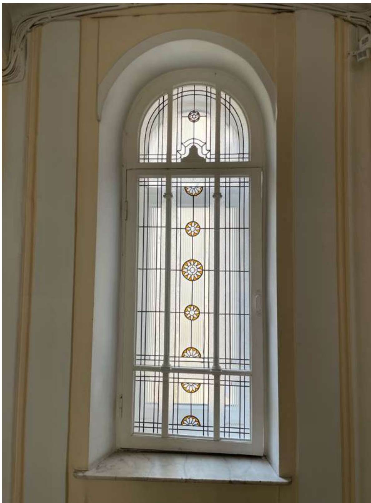
110. Фрагмент интерьера лестницы 1ЛК
