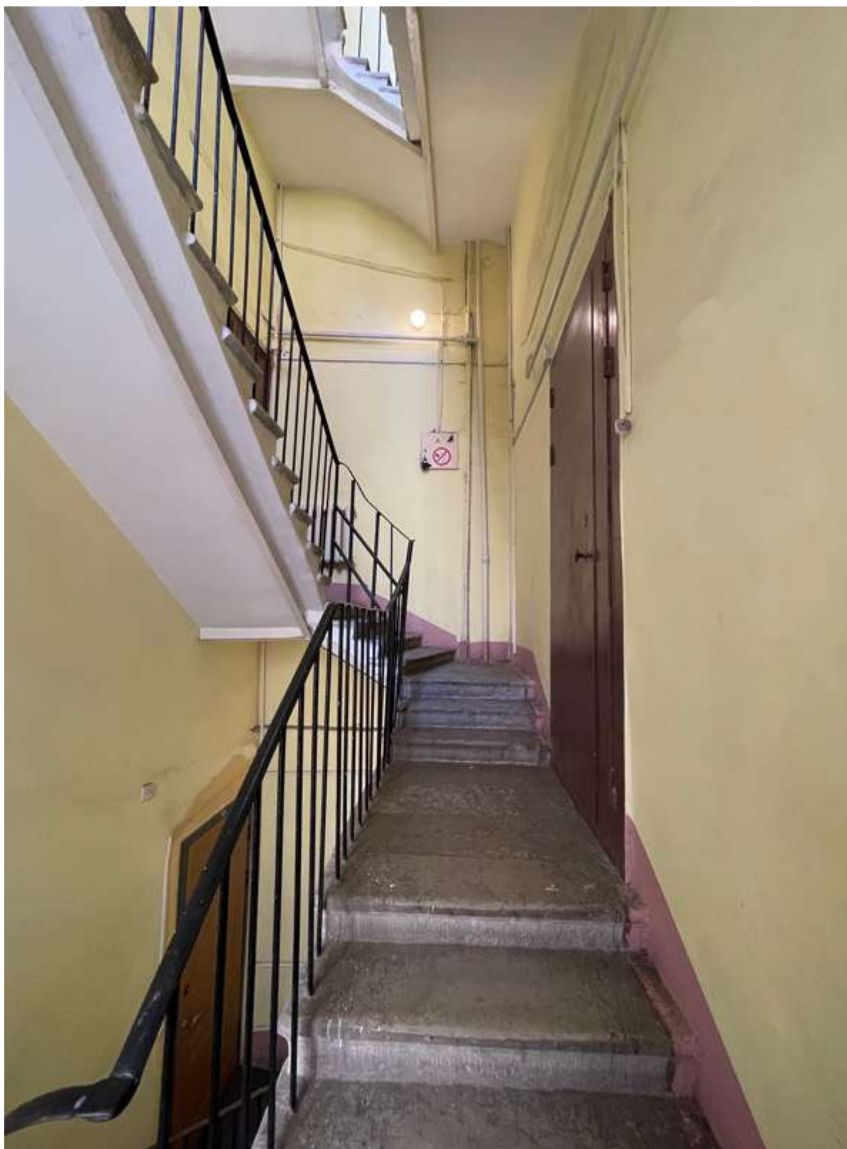
91. Фрагмент интерьера лестницы 2ЛК
