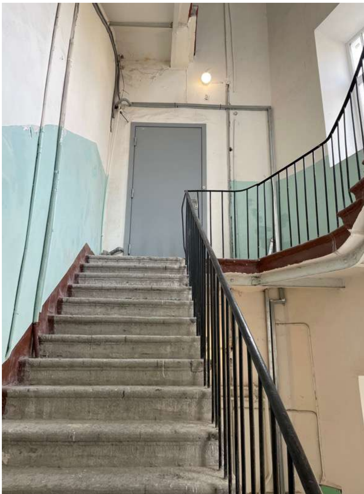
85. Фрагмент интерьера лестницы 6ЛК
