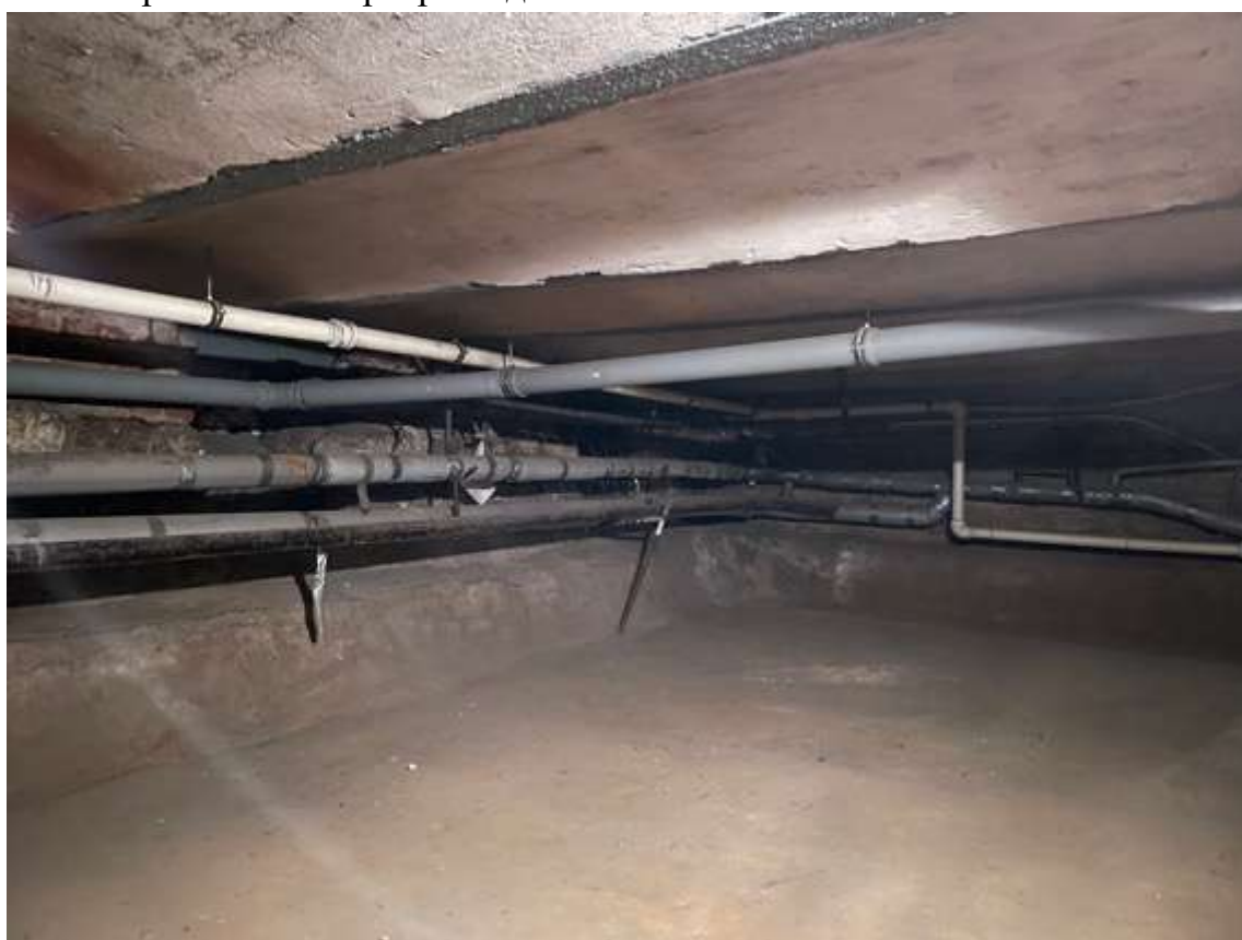
23. Фрагмент интеръера подвала
