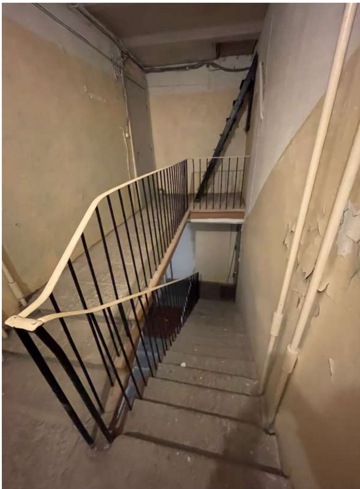
35. Фрагмент интерьера лестницы 5ЛК
