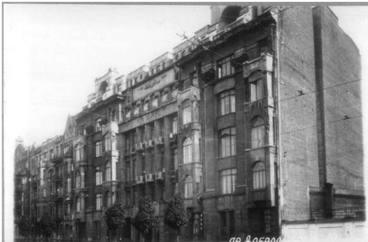
152. Фасад дома №19. 1960 г. ЦГАКФФД СПб. Фотодокументы. Опись 1ГР-48. Ед.хр.74033
