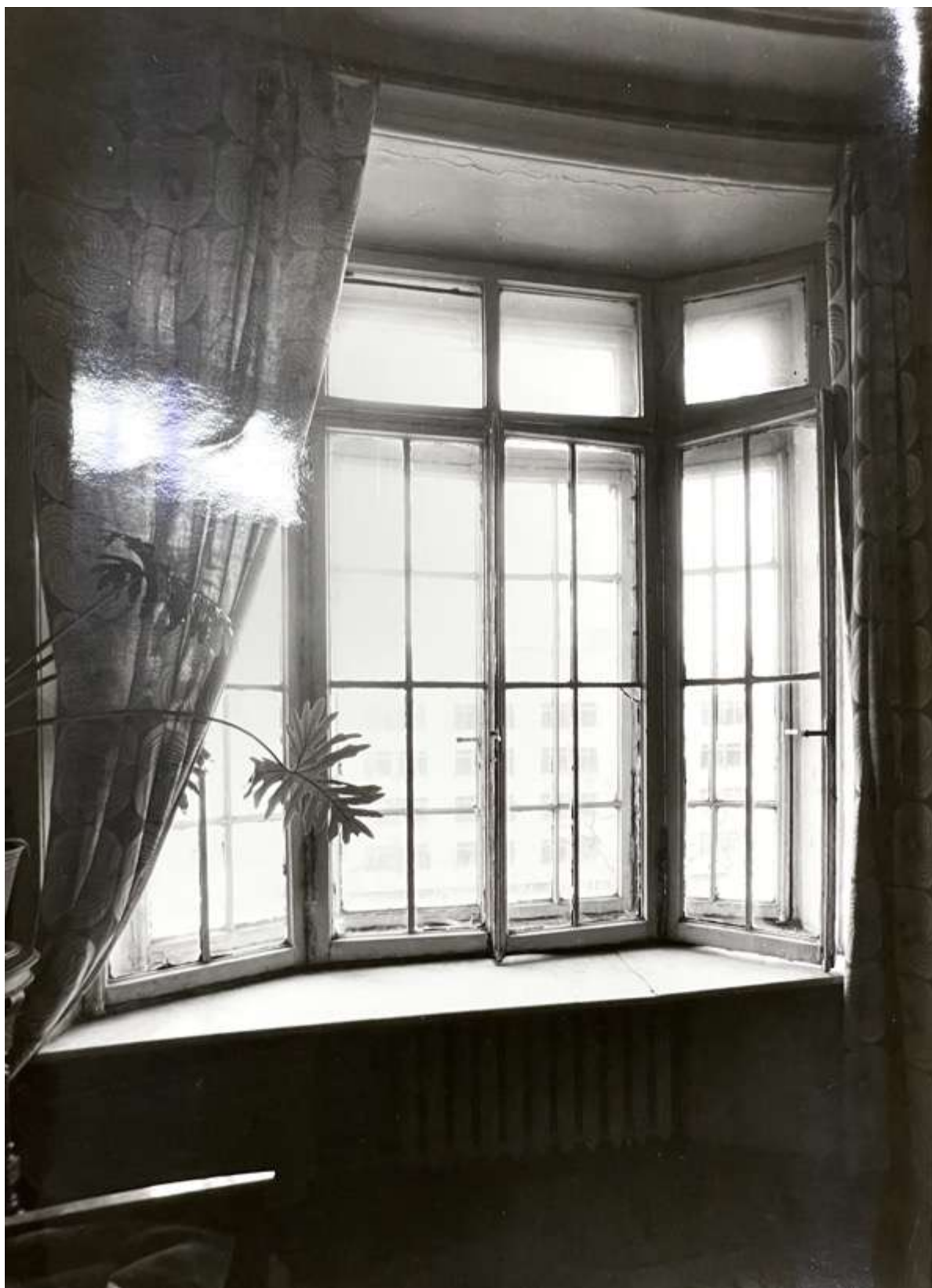
175. Юго-западная стена с окном (четвертый этаж, квартира 6). 1986 г. Архив КГИОП 57285/1-Н
