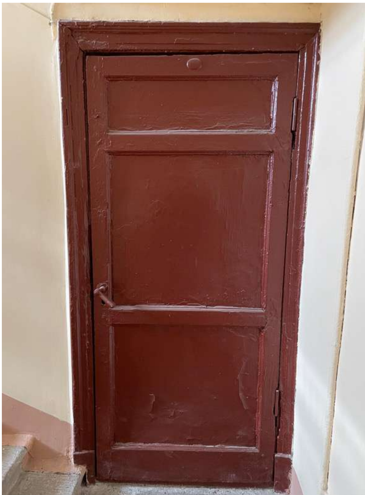
74. Фрагмент интерьера лестницы ЗЛК
