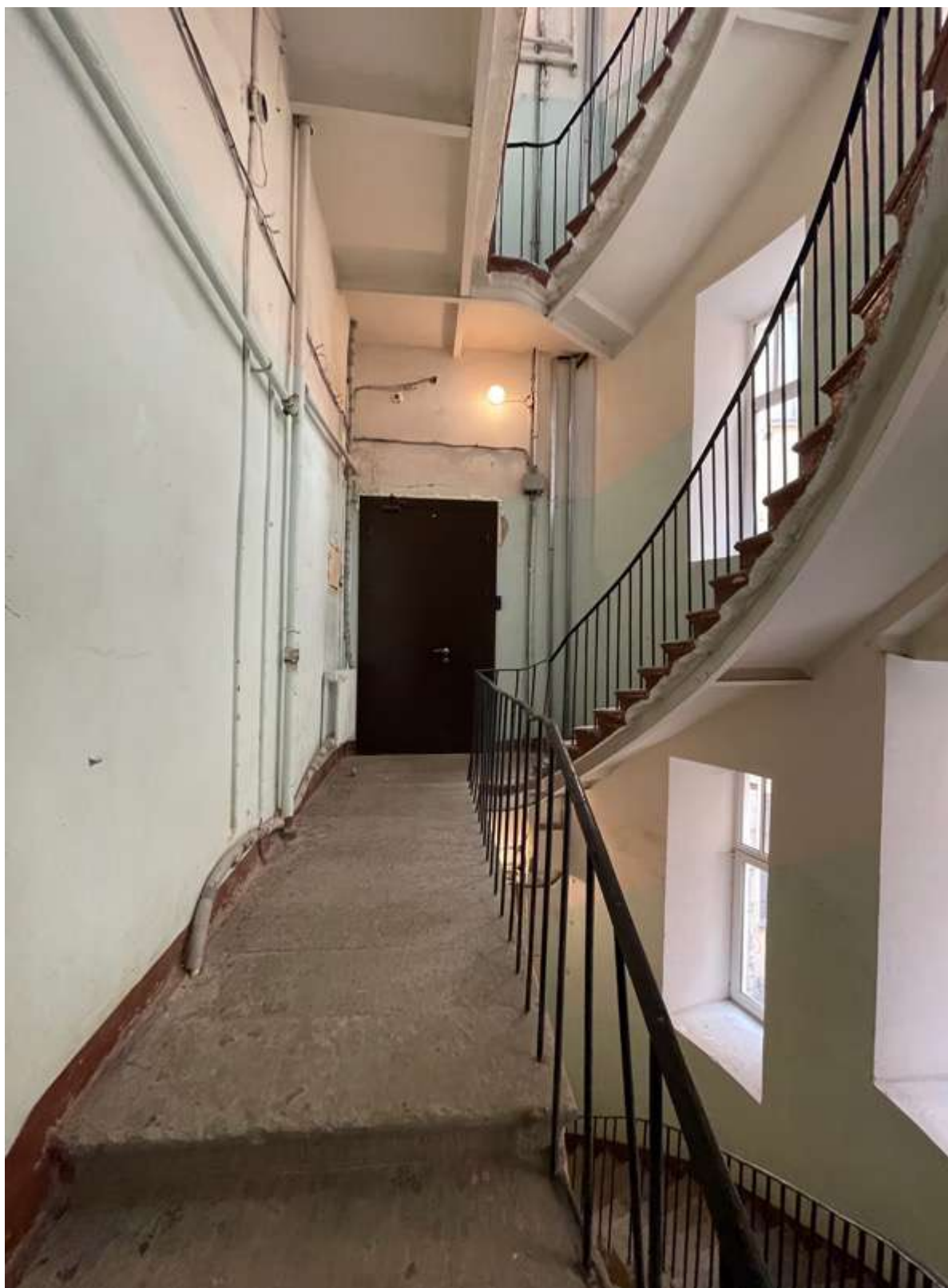
80. Фрагмент интерьера лестницы 6ЛК
