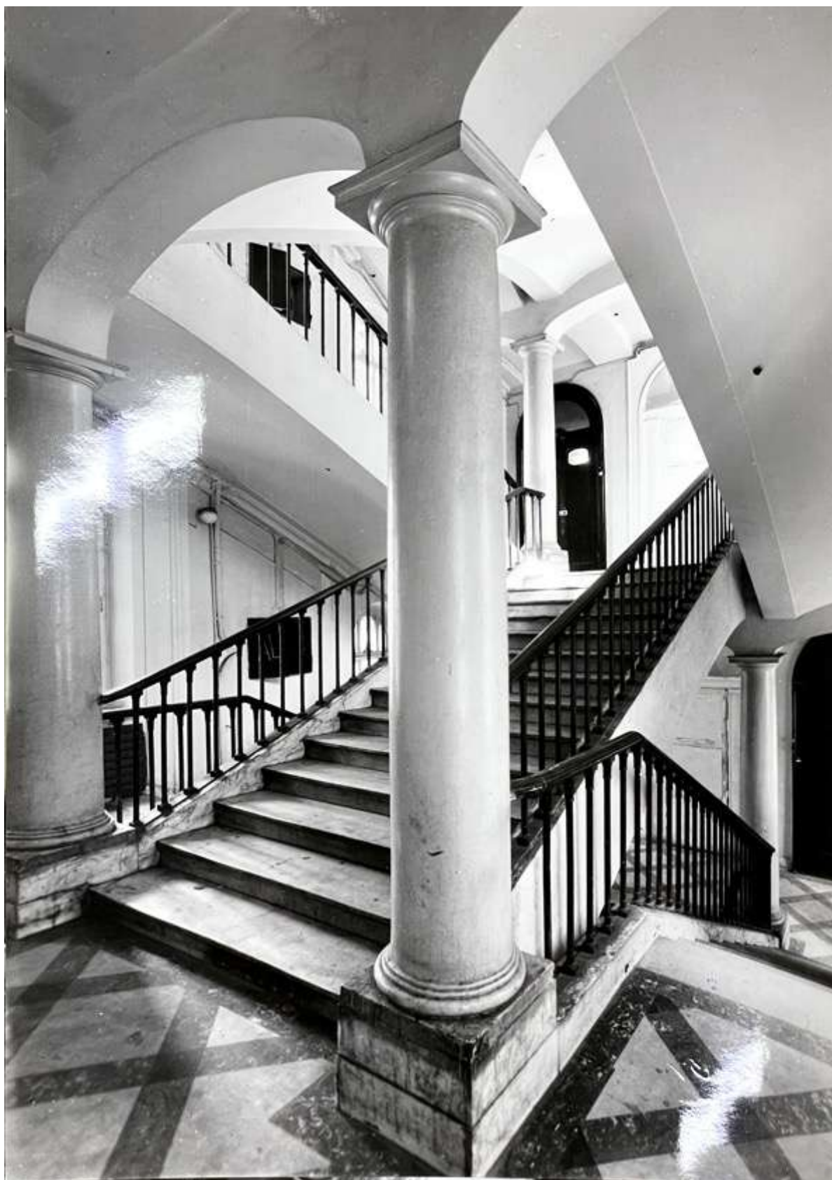
157. Парадная лестница. Лестничный марш. 1986 г. Архив КГИОП 57272/1-Н
