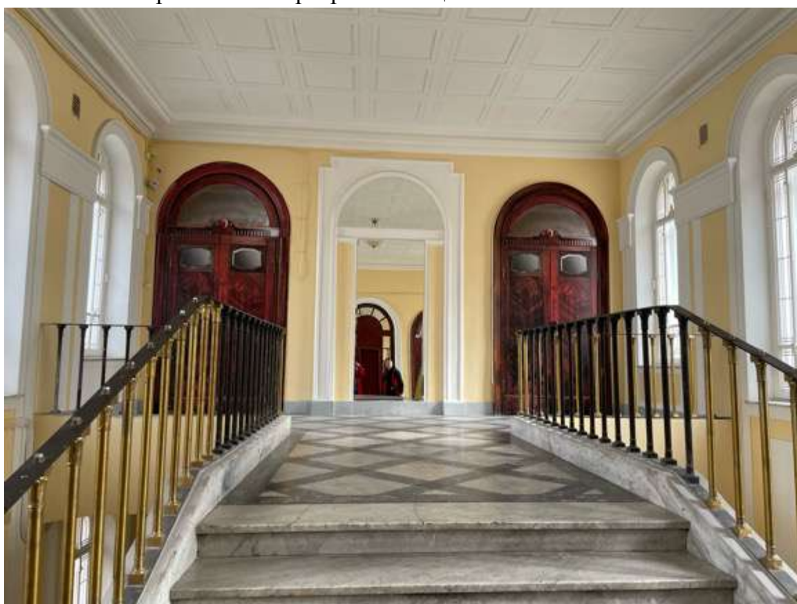
102. Фрагмент интерьера лестницы 1ЛК
