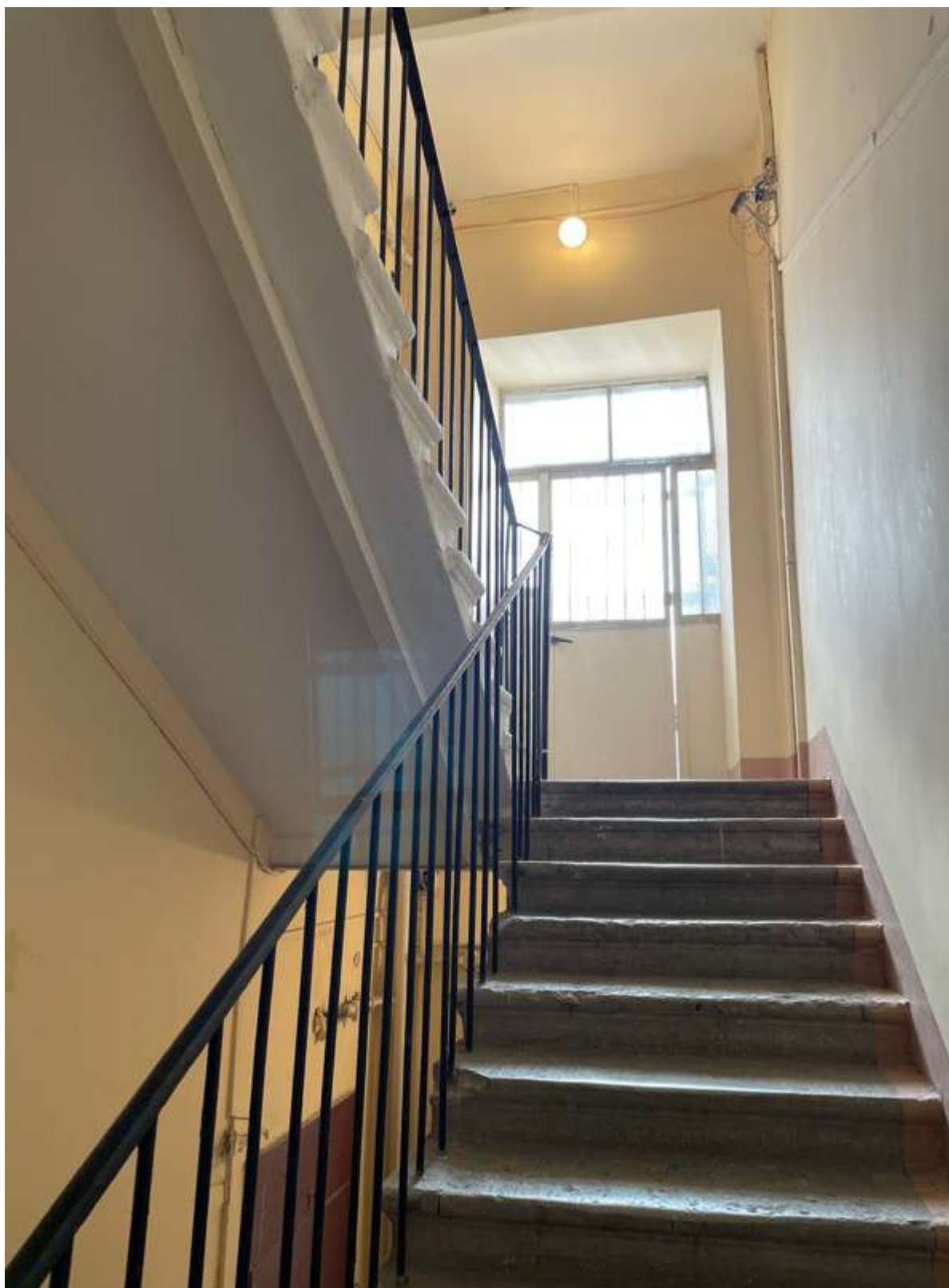
72. Фрагмент интерьера лестницы ЗЛК
