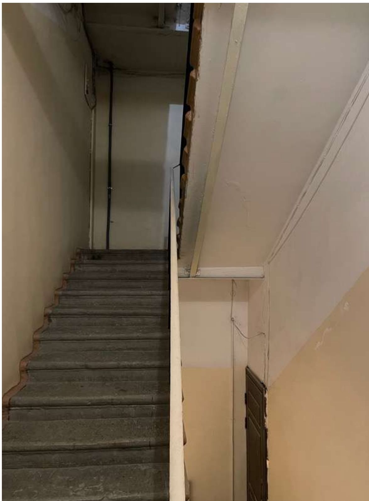
40. Фрагмент интерьера лестницы 5ЛК
