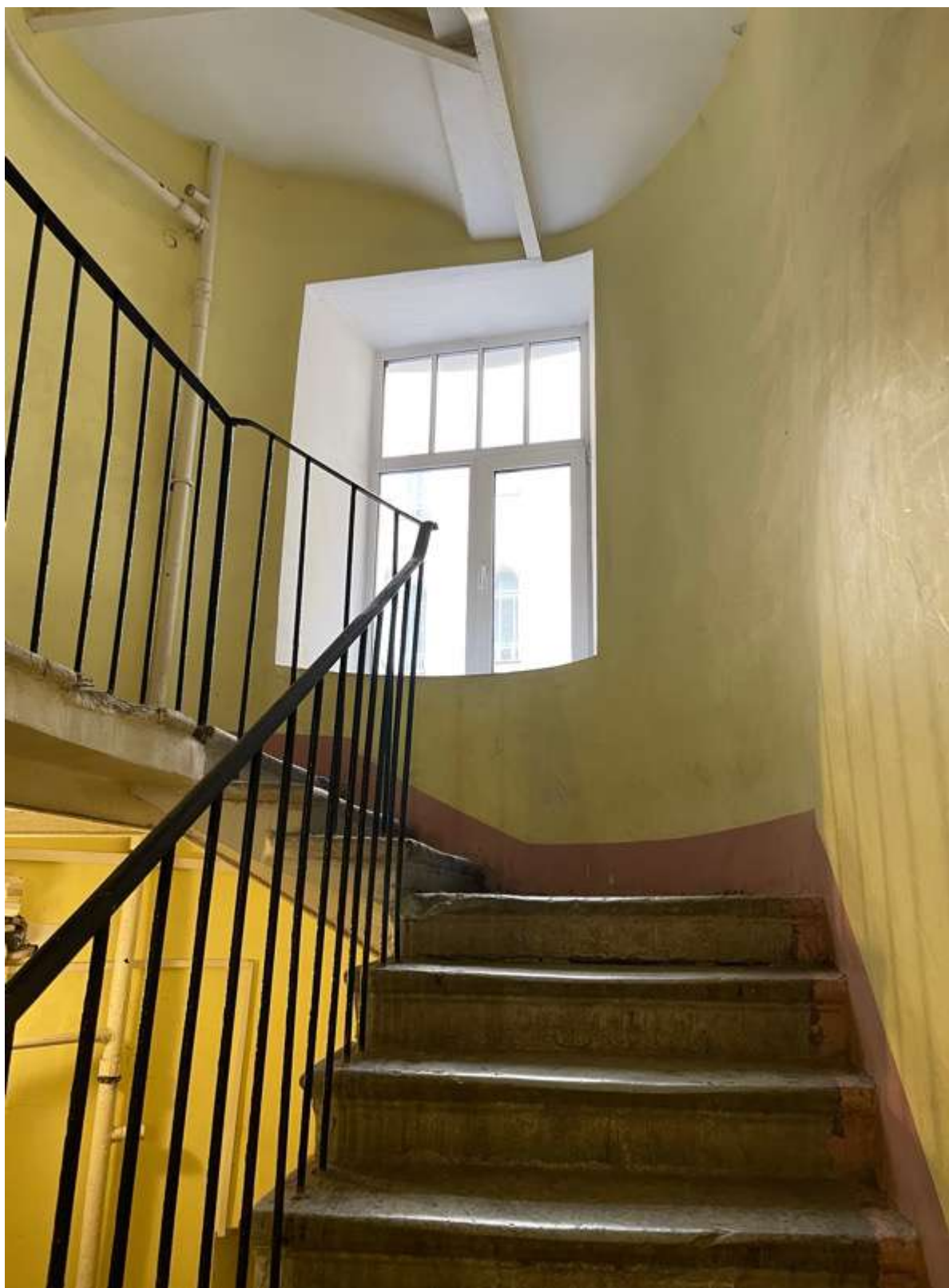
89. Фрагмент интерьера лестницы 2ЛК
