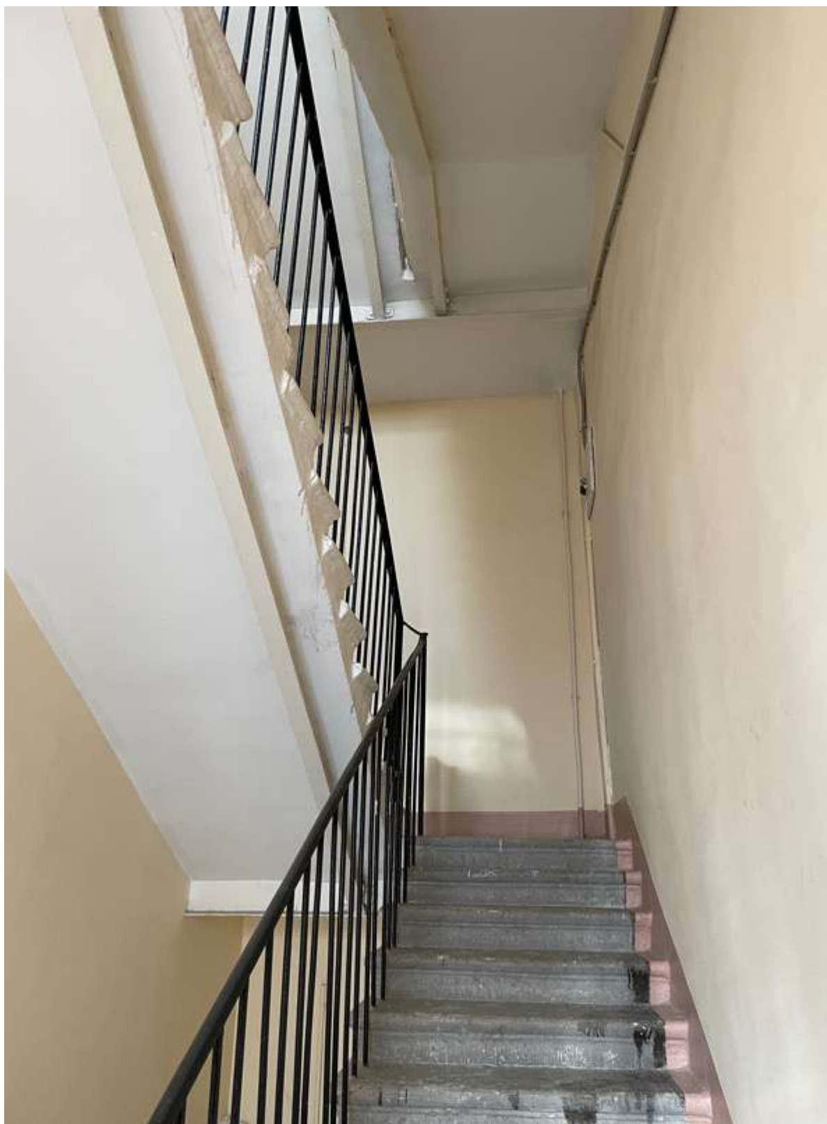
73. Фрагмент интерьера лестницы ЗЛК
