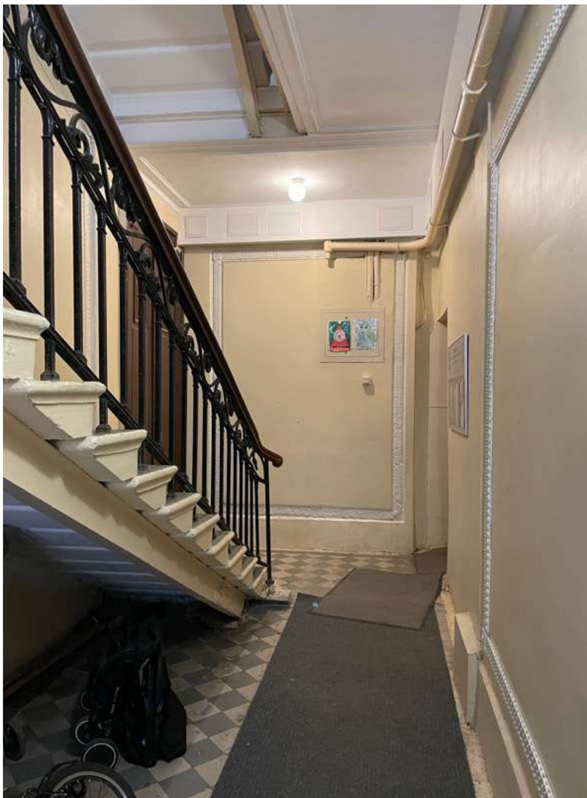
65. Фрагмент интерьера лестницы 4ЛК
