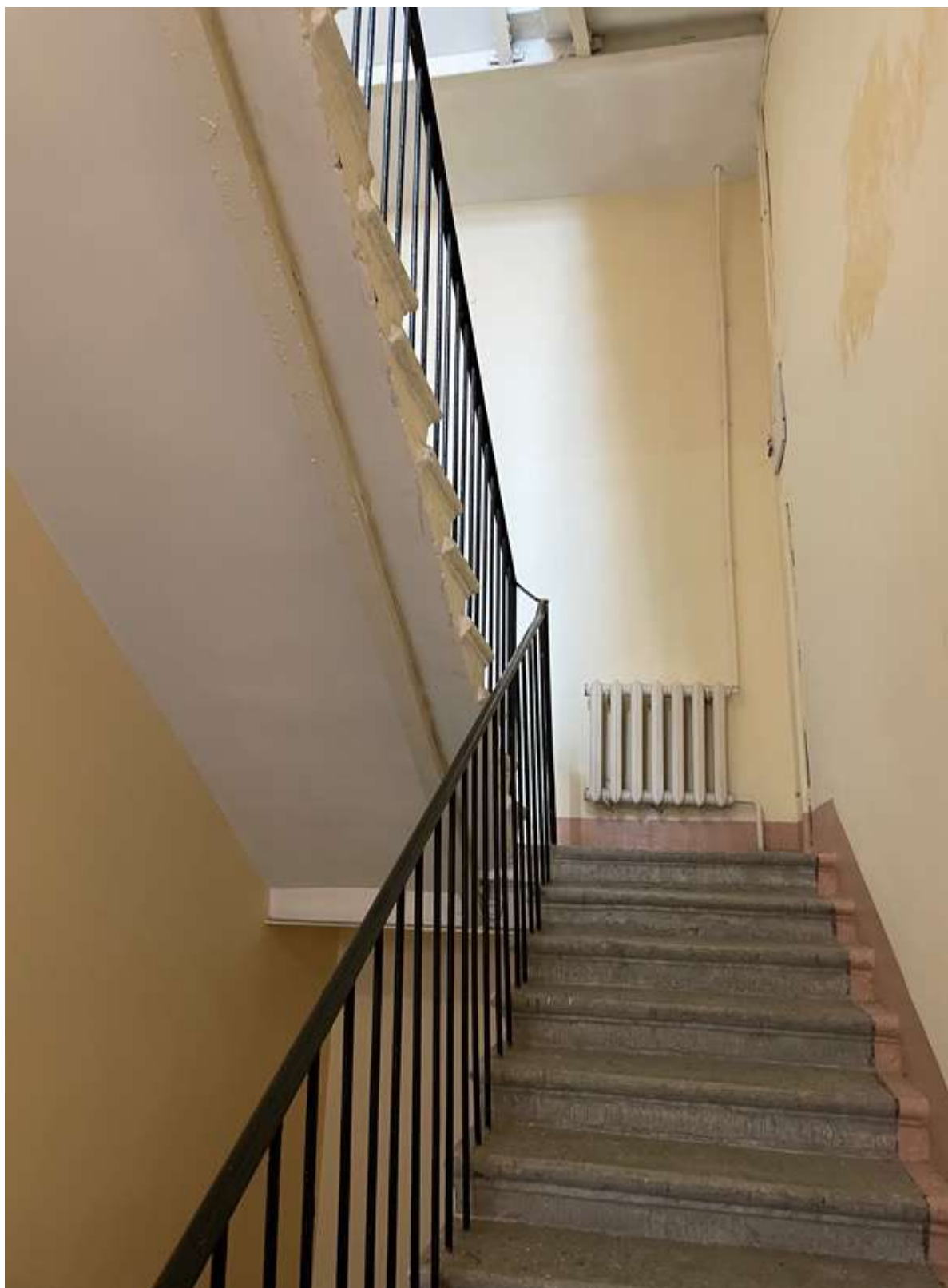
70. Фрагмент интерьера лестницы ЗЛК
