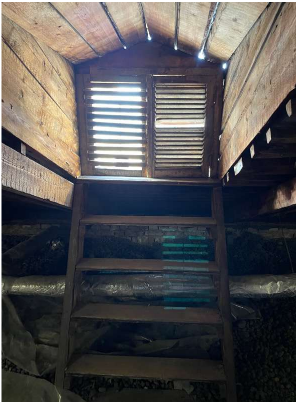
30. Фрагмент интеръера чердака
