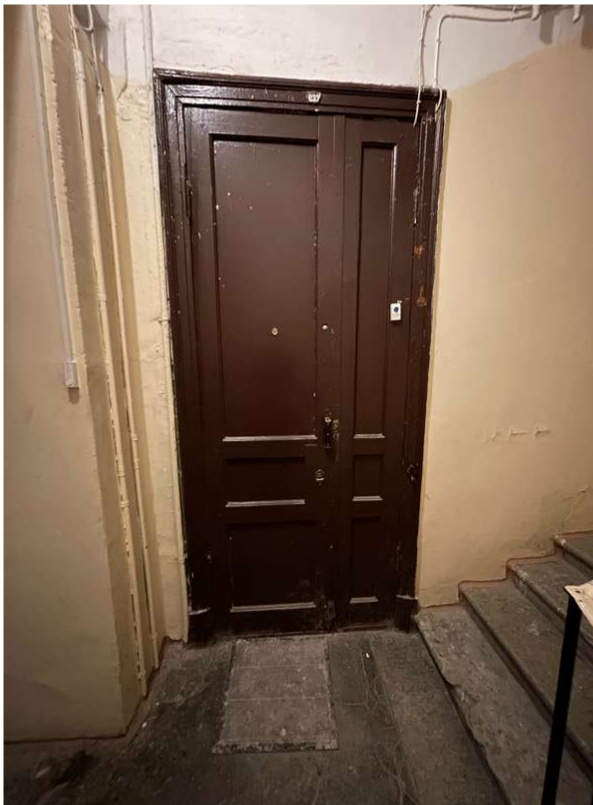
39. Фрагмент интерьера лестницы 5ЛК
