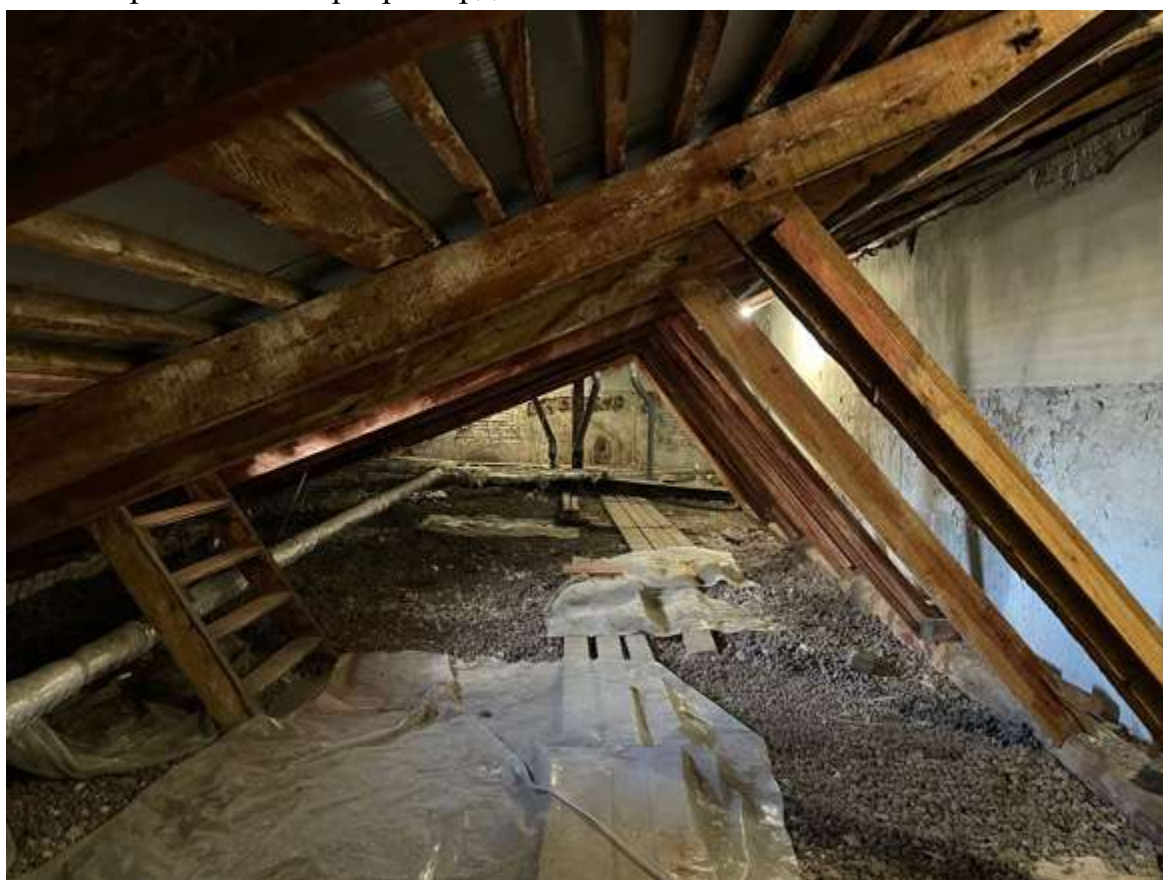
29. Фрагмент интеръера чердака
