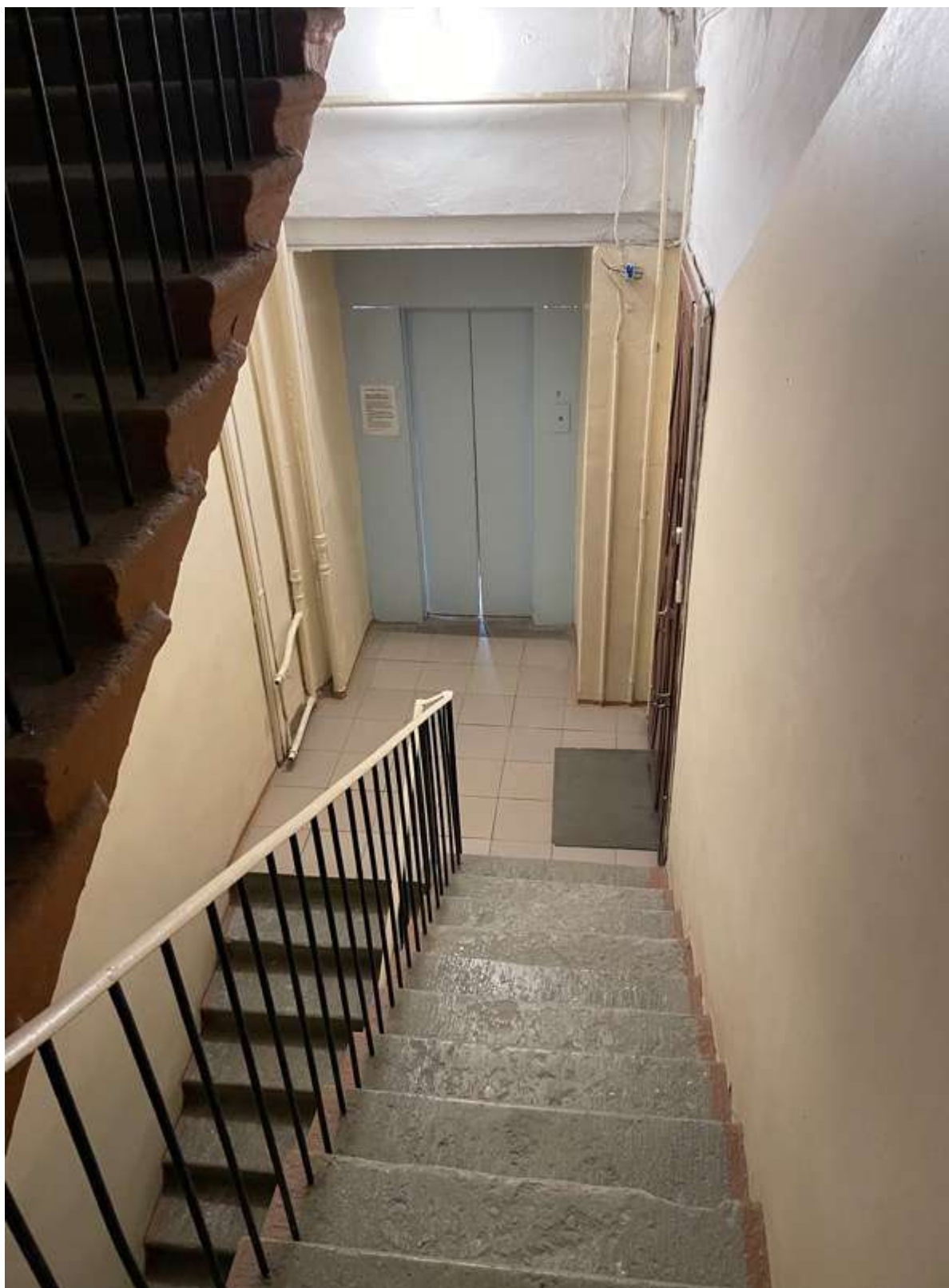
41. Фрагмент интерьера лестницы 5ЛК
