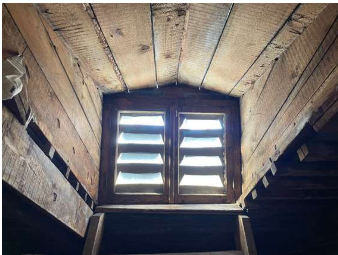
28. Фрагмент интеръера чердака
