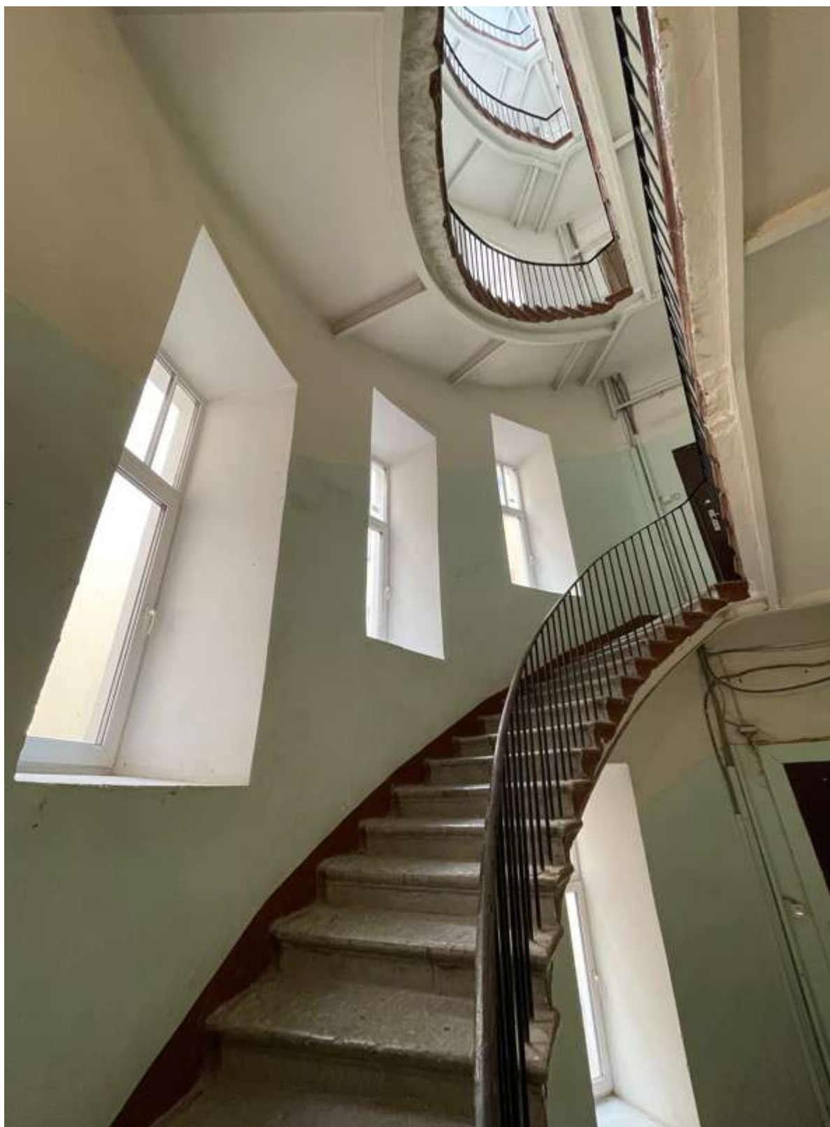
81. Фрагмент интерьера лестницы 6ЛК
