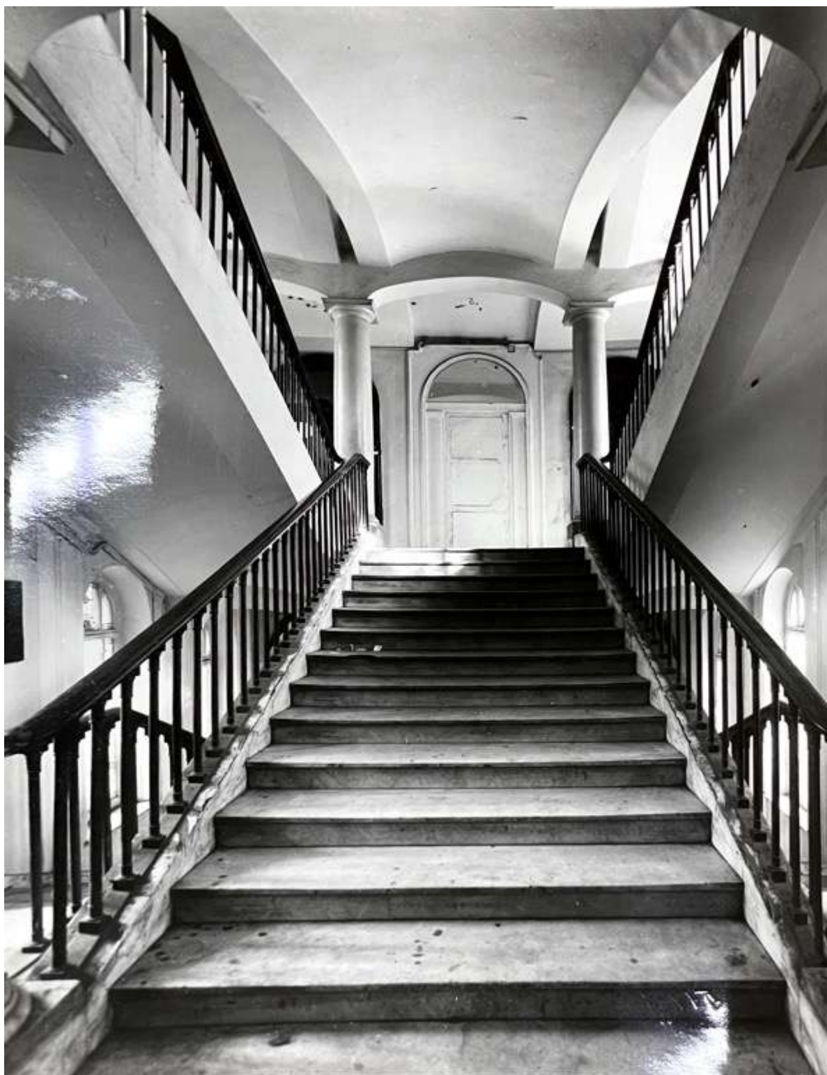
156. Парадная лестница. Лестничный марш. 1986 г. Архив КГИОП 57271/1-Н
