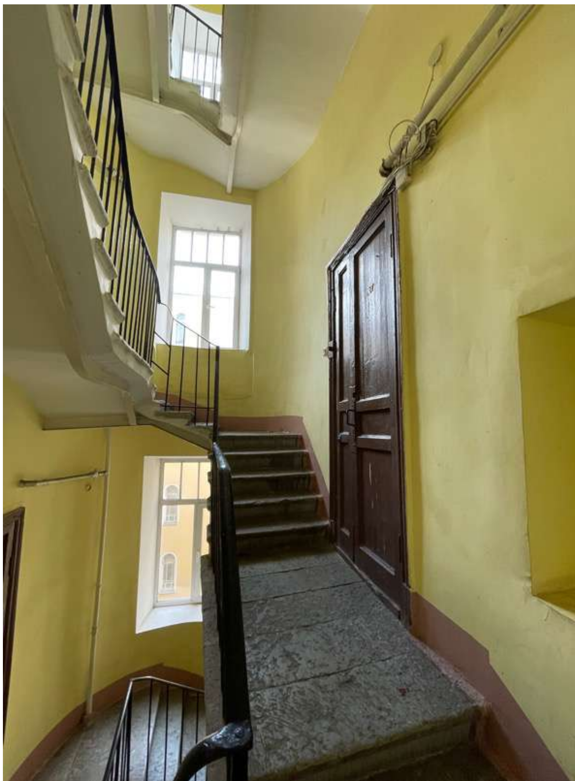
94. Фрагмент интерьера лестницы 2ЛК
