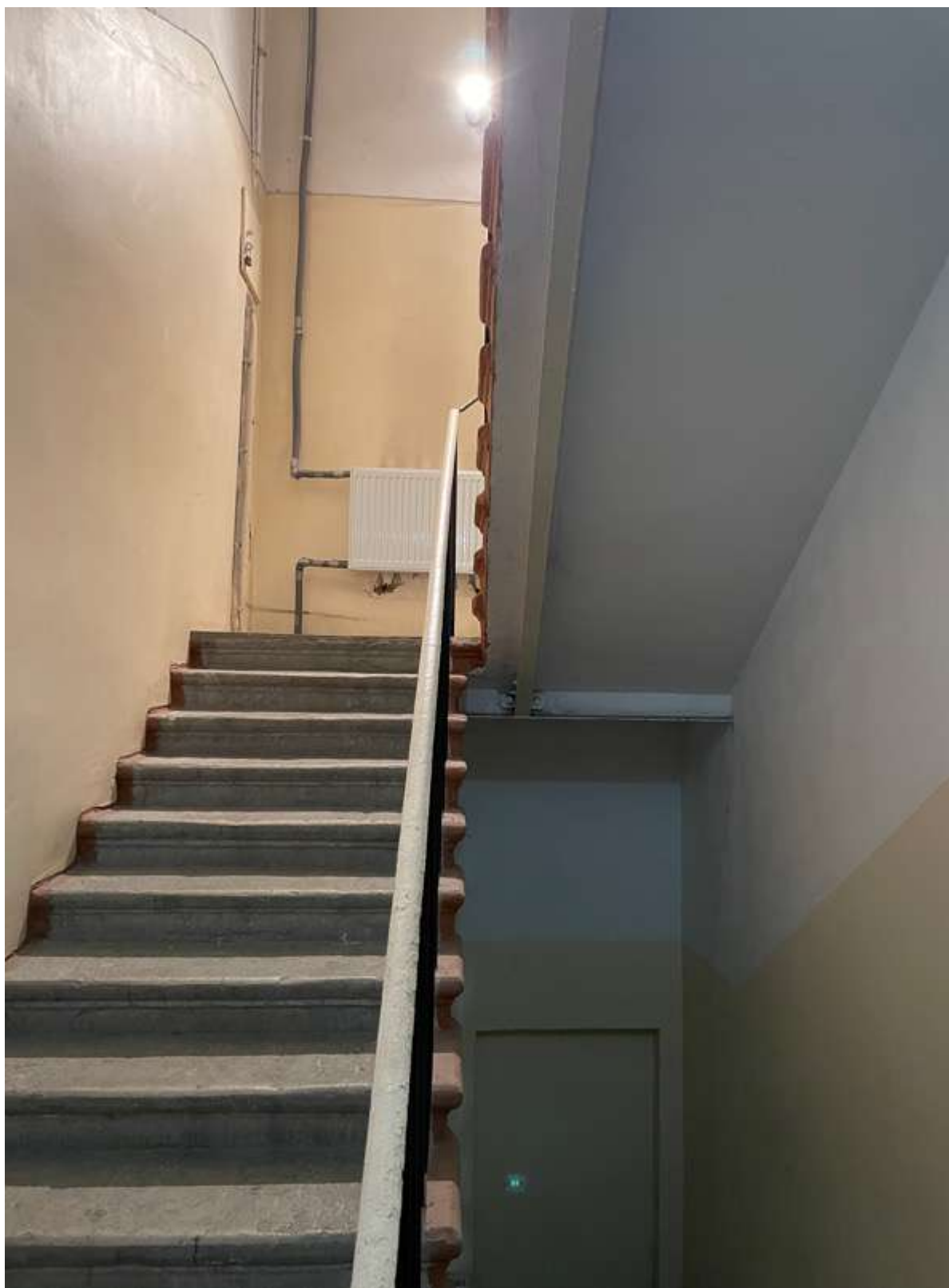
44. Фрагмент интерьера лестницы 5ЛК
