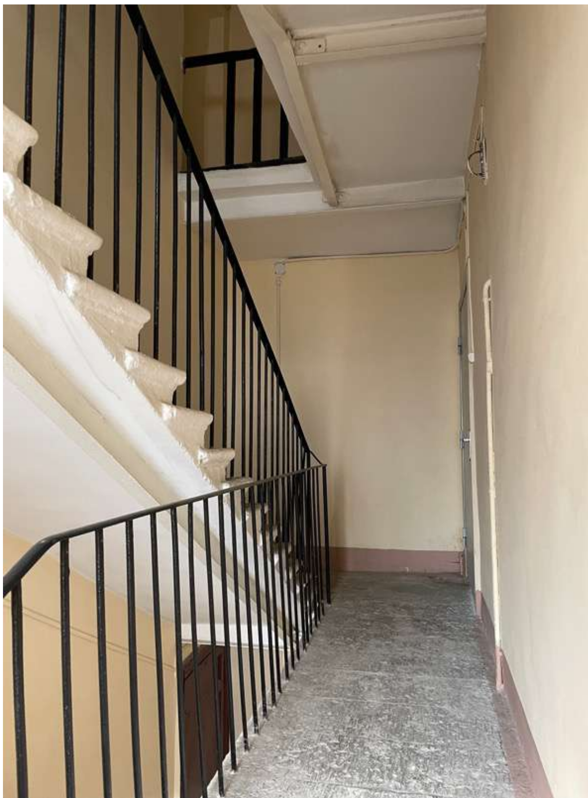
75. Фрагмент интерьера лестницы ЗЛК
