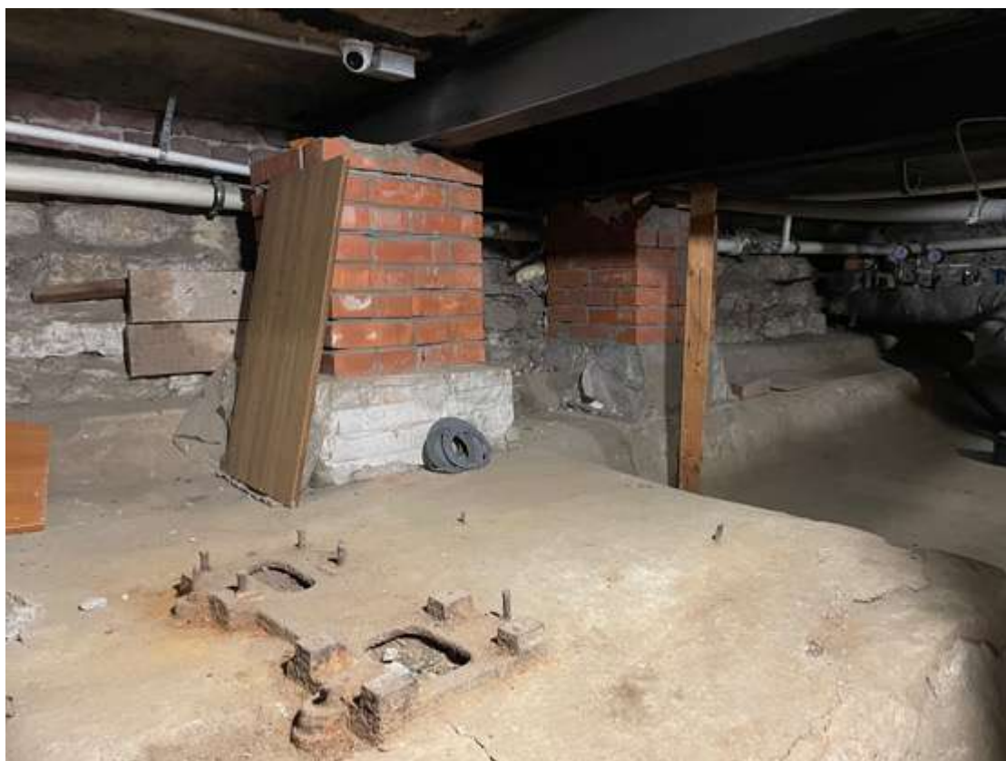
22. Фрагмент интеръера подвала
