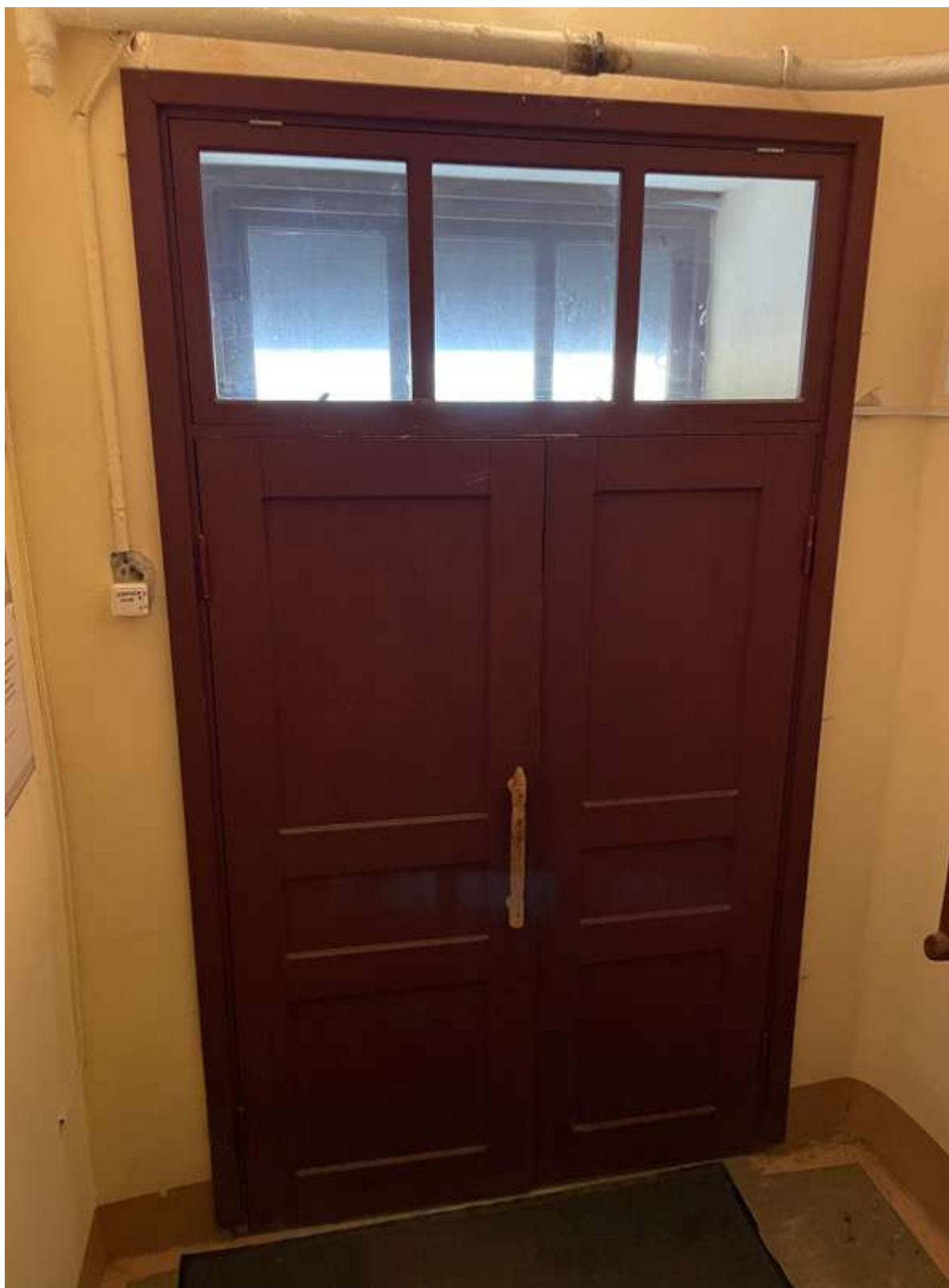
77. Фрагмент интерьера лестницы ЗЛК
