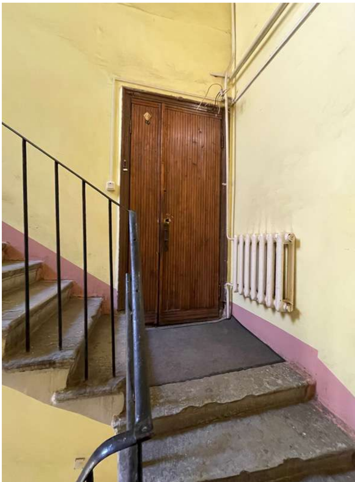
92. Фрагмент интерьера лестницы 2ЛК
