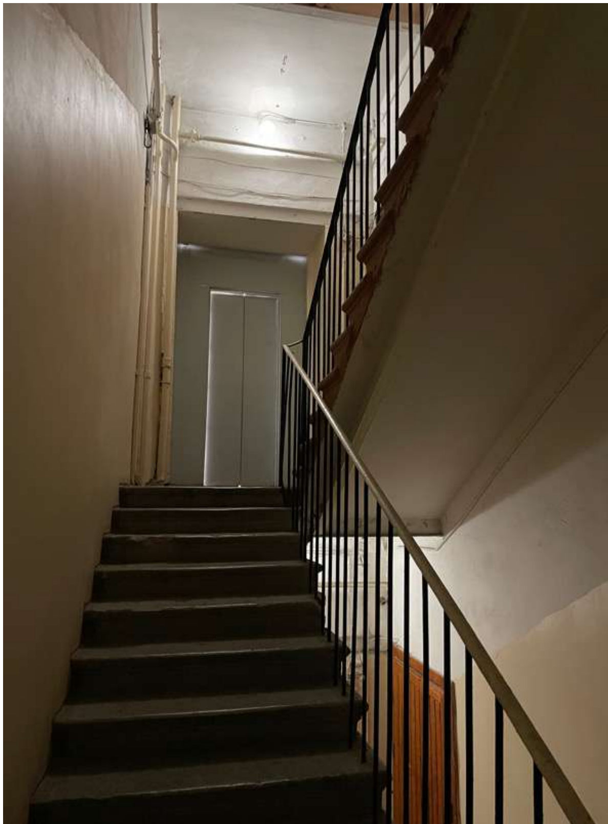
46. Фрагмент интерьера лестницы 5ЛК
