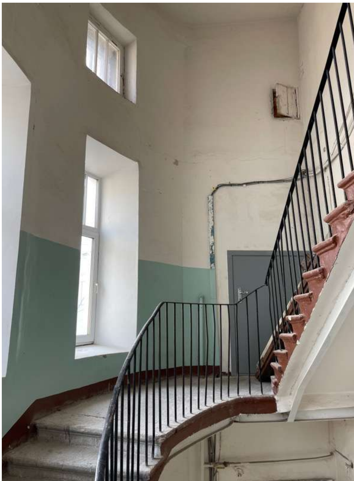
86. Фрагмент интерьера лестницы 6ЛК
