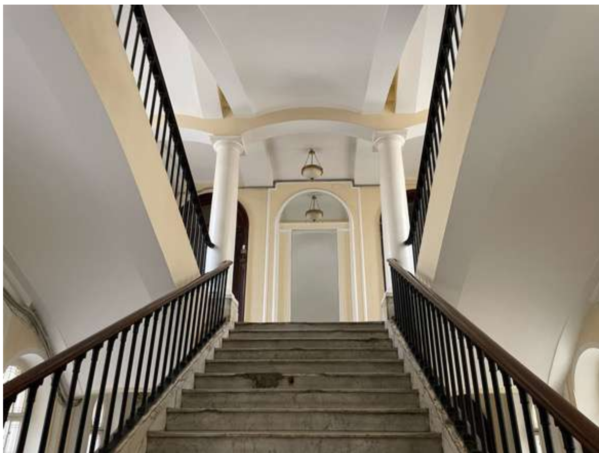
111. Фрагмент интерьера лестницы 1ЛК
