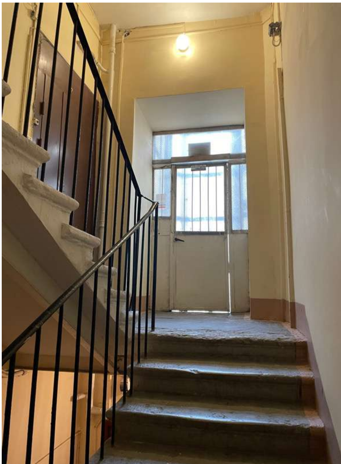
67. Фрагмент интерьера лестницы ЗЛК
