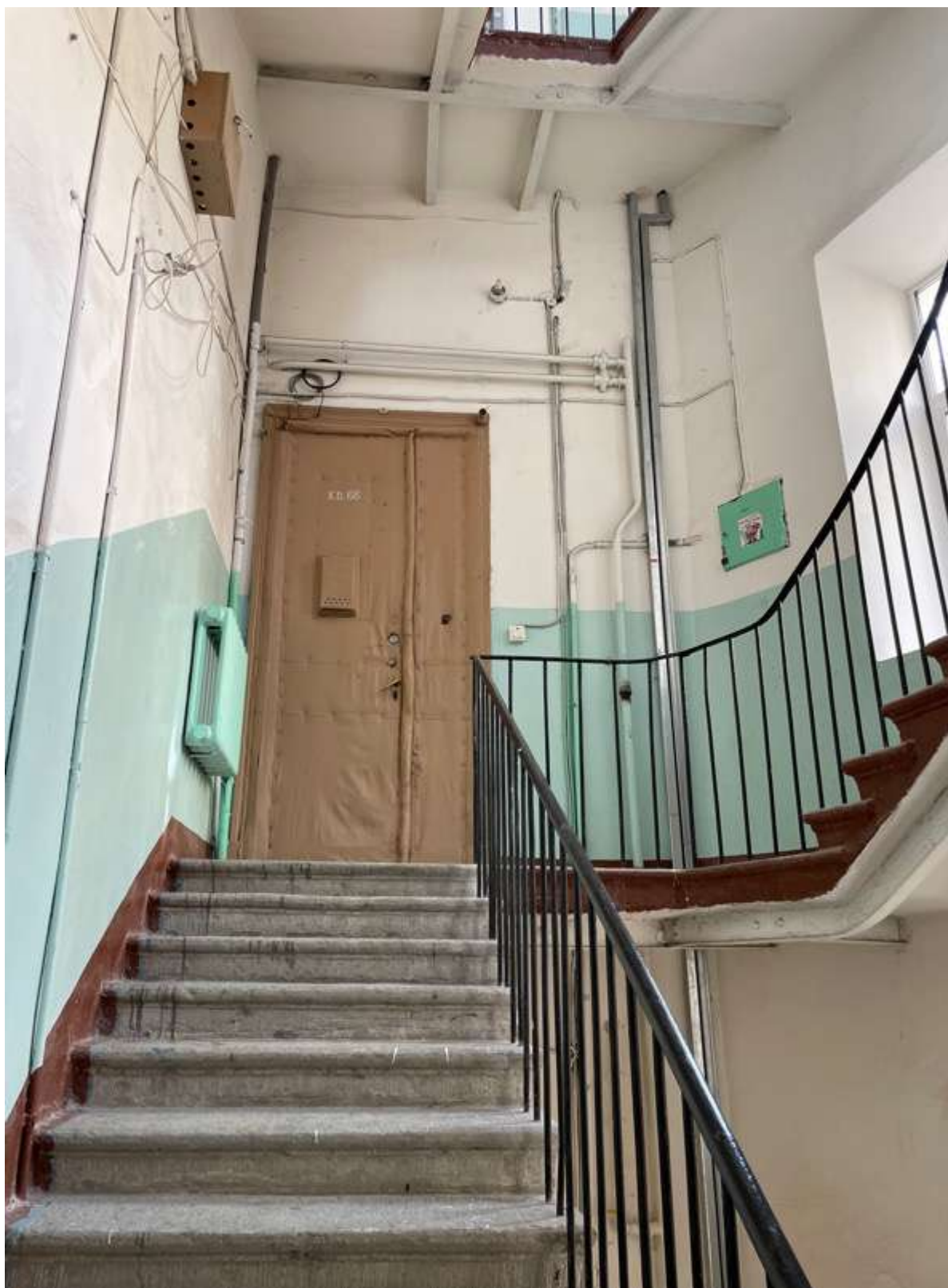
84. Фрагмент интерьера лестницы 6ЛК
