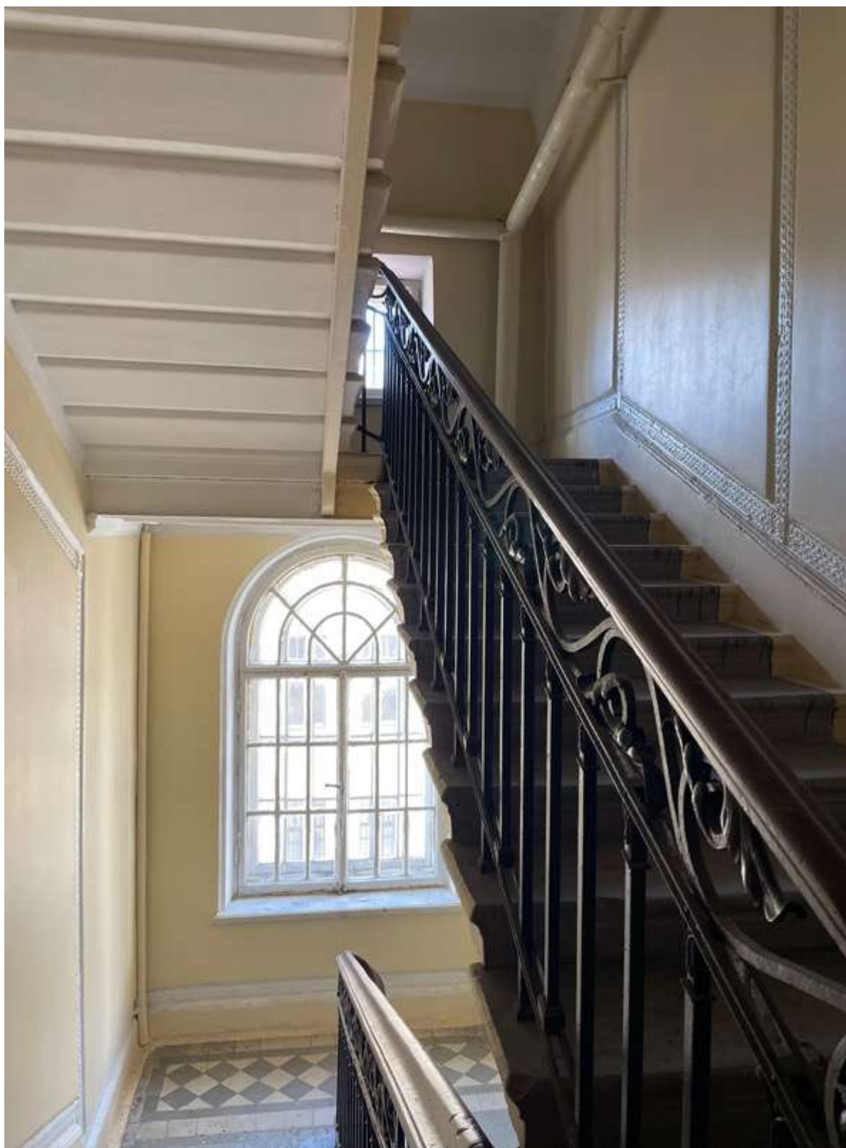
52. Фрагмент интерьера лестницы 4ЛК
