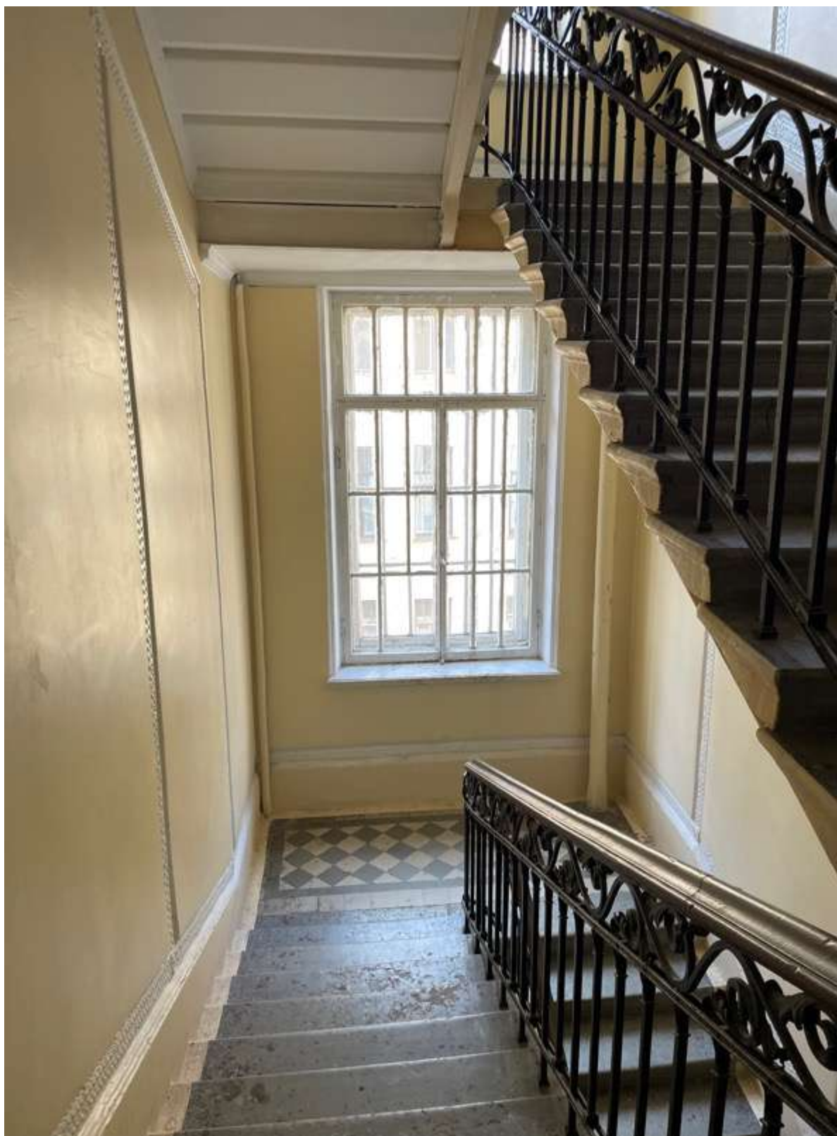
55. Фрагмент интерьера лестницы 4ЛК
