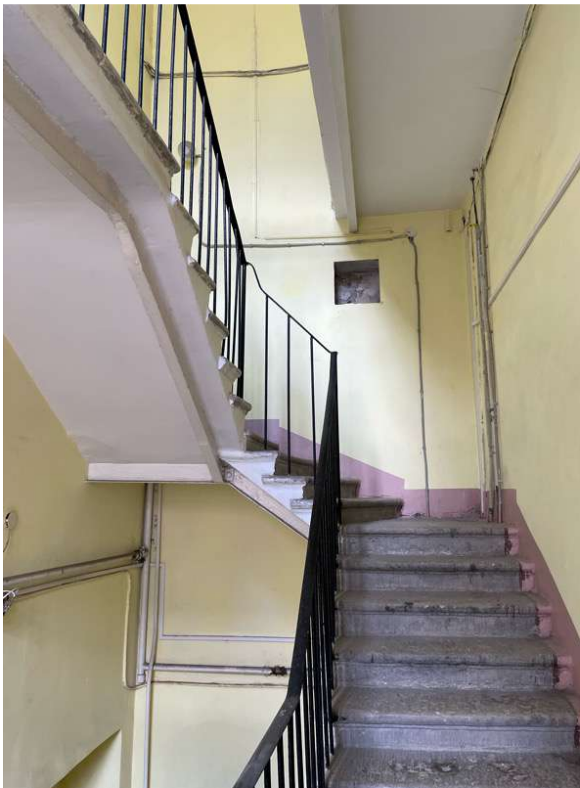
95. Фрагмент интерьера лестницы 2ЛК
