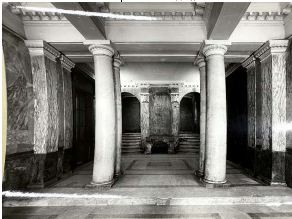
155. Парадная лестница. Вид вестибюля, северо-восточная стена. 1986 г. Архив КГИОП 57270/1-Н
