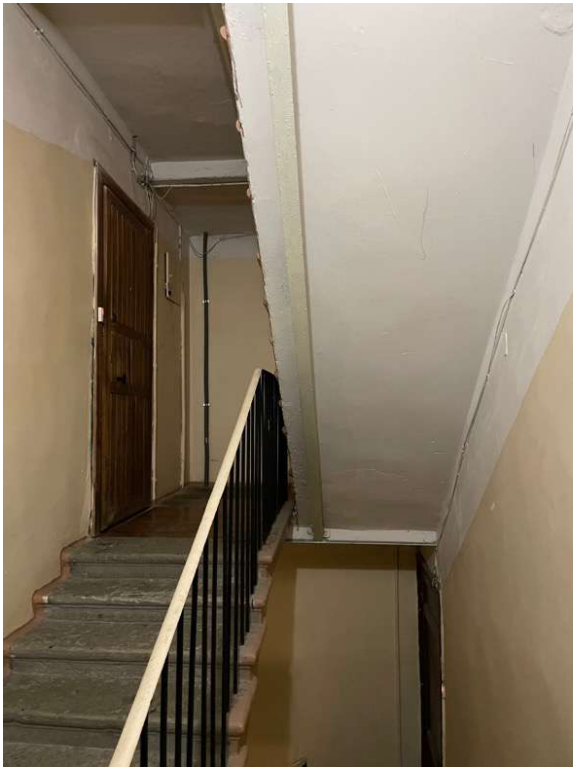
37. Фрагмент интерьера лестницы 5ЛК
