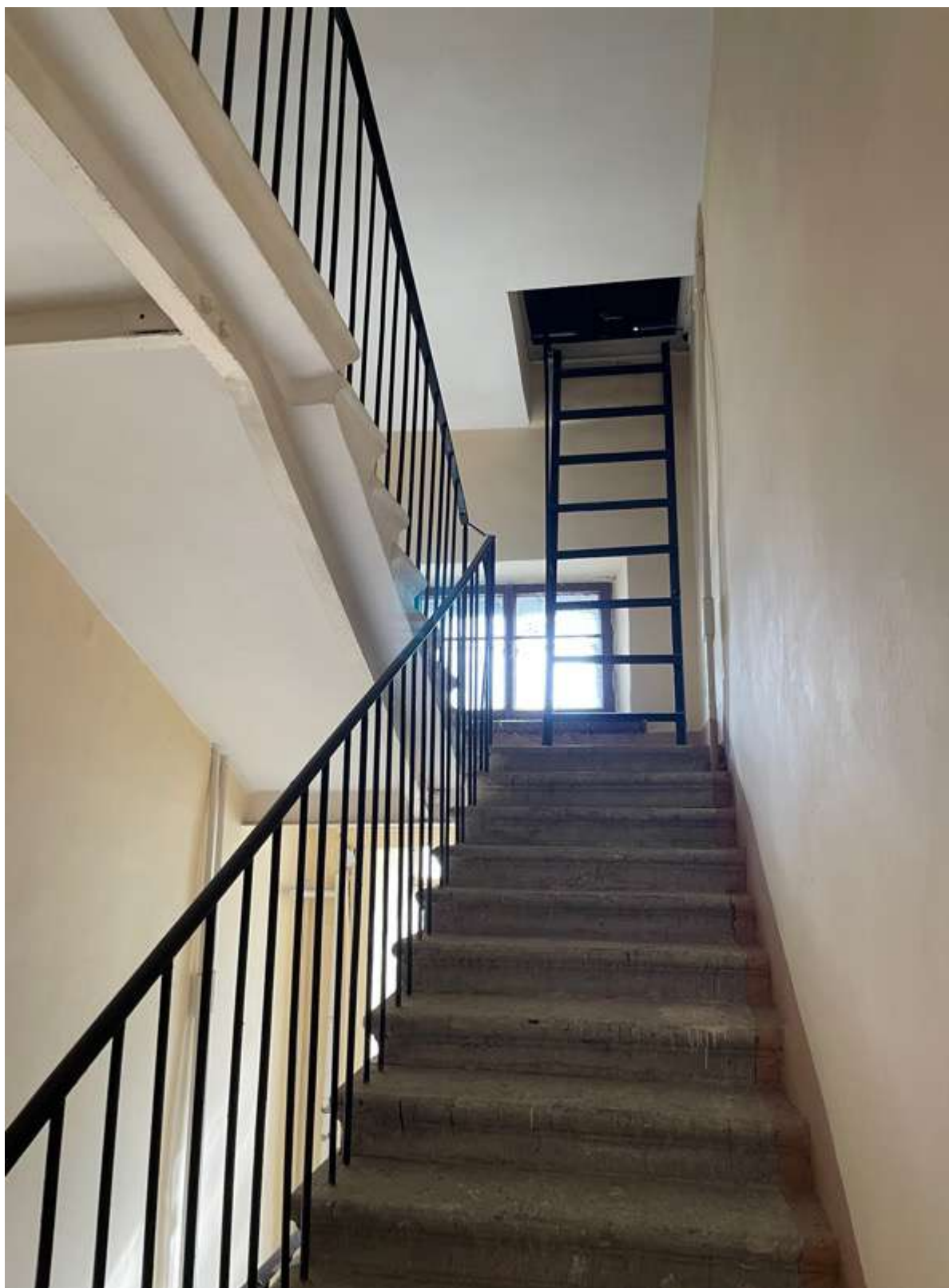
76. Фрагмент интерьера лестницы ЗЛК
