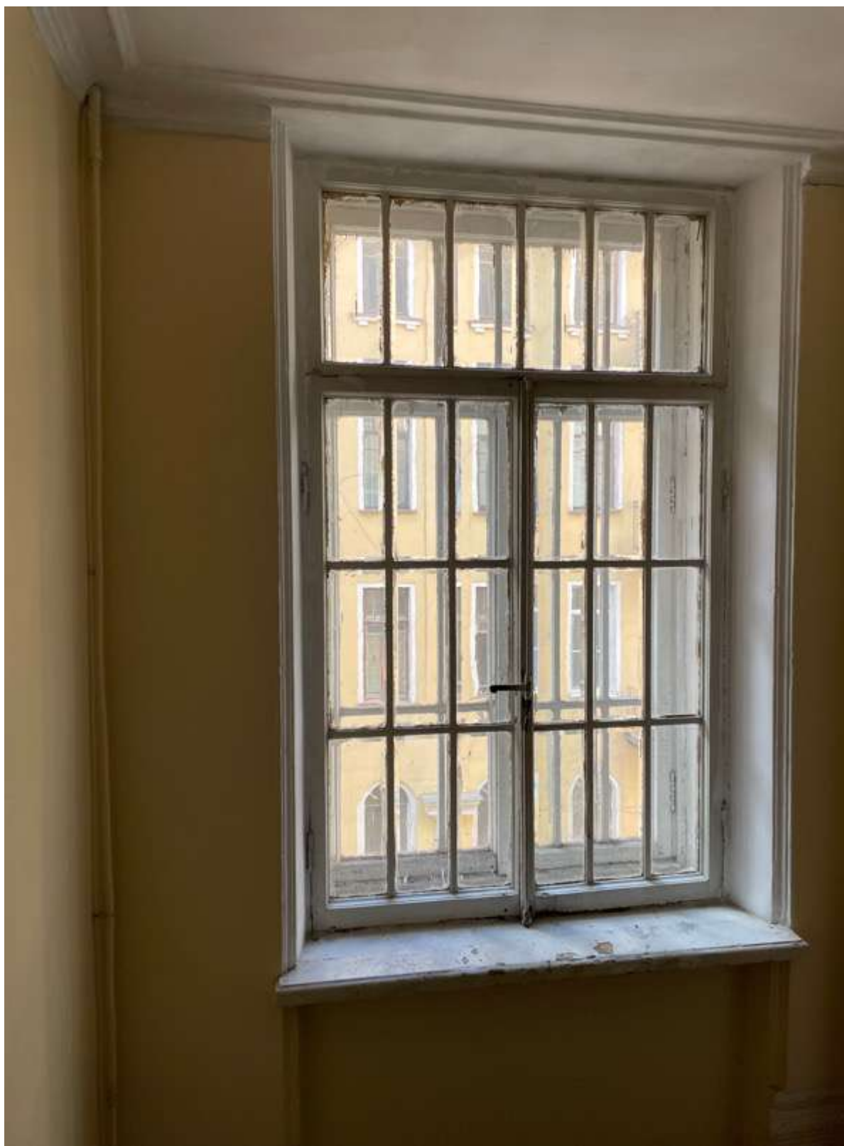
57. Фрагмент интерьера лестницы 4ЛК
