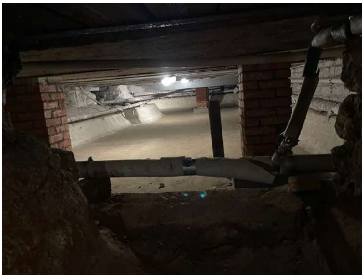
26. Фрагмент интерьера подвала
