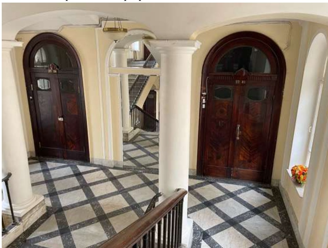
109. Фрагмент интерьера лестницы 1ЛК
