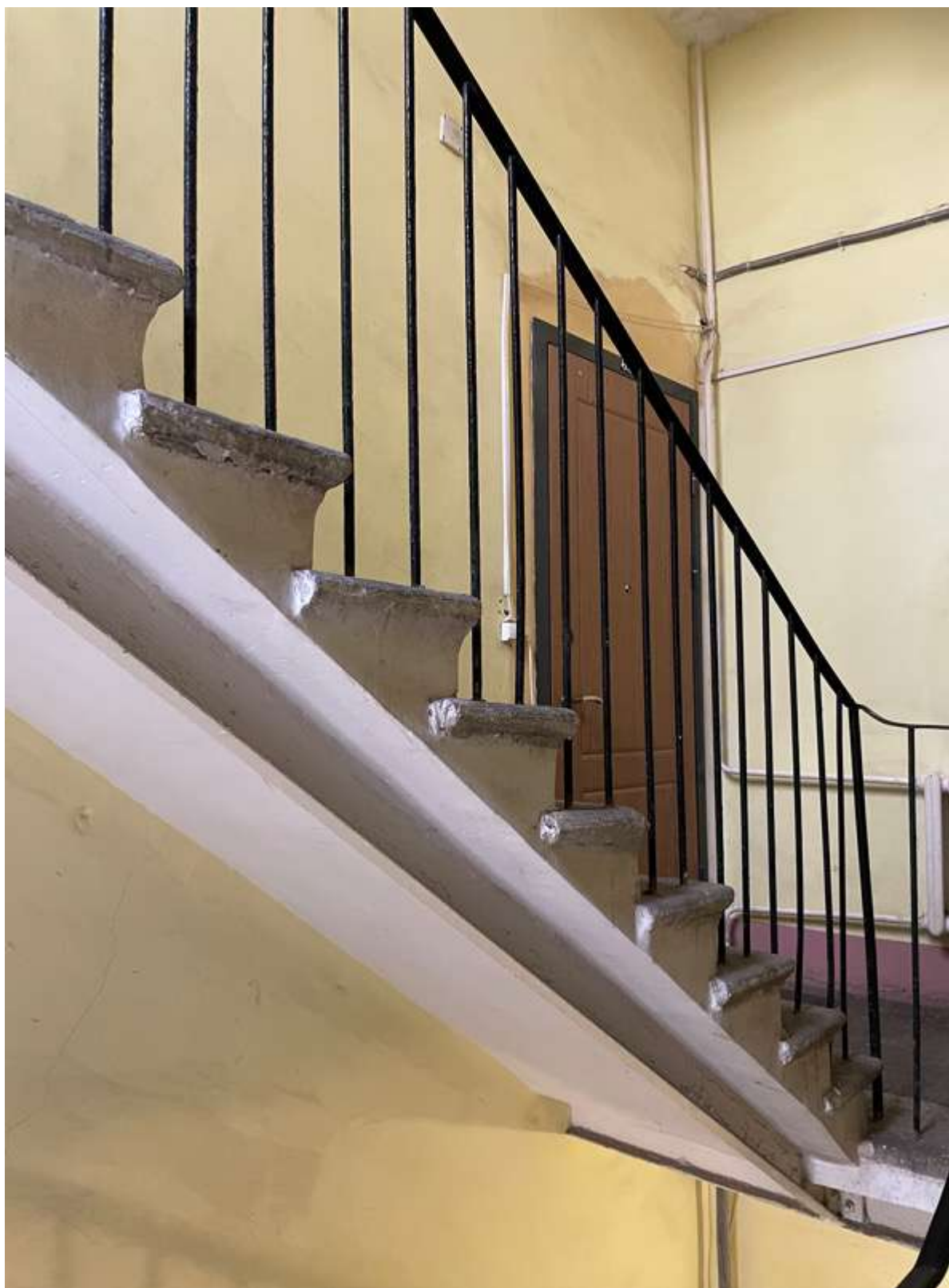
90. Фрагмент интерьера лестницы 2ЛК
