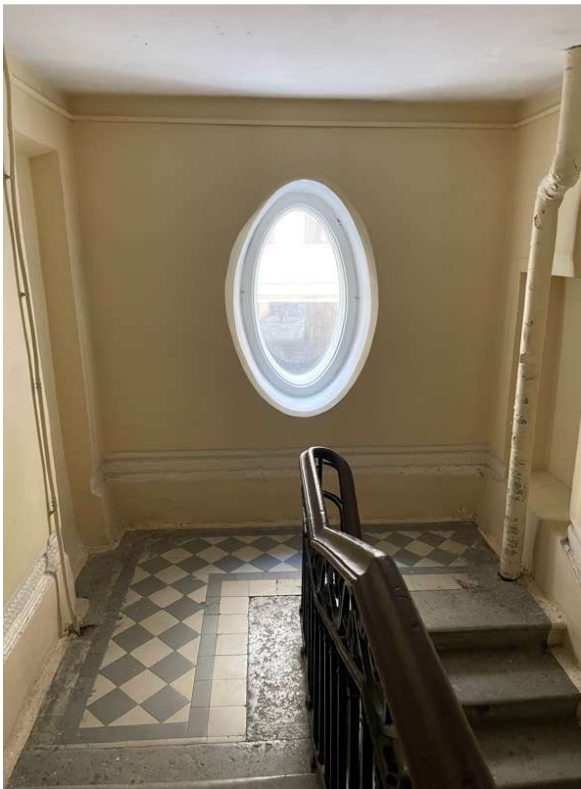
62. Фрагмент интерьера лестницы 4ЛК
