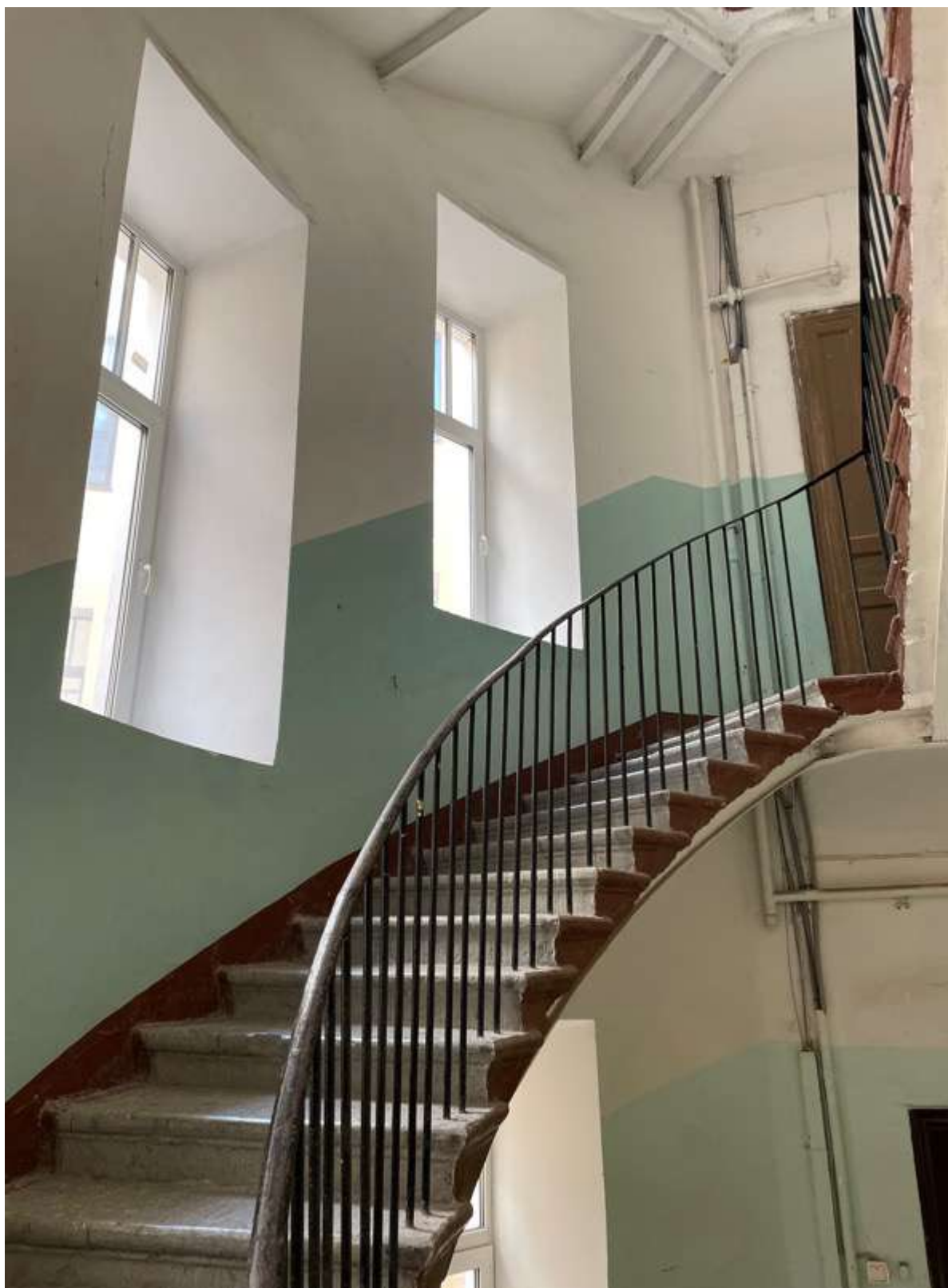
83. Фрагмент интерьера лестницы 6ЛК
