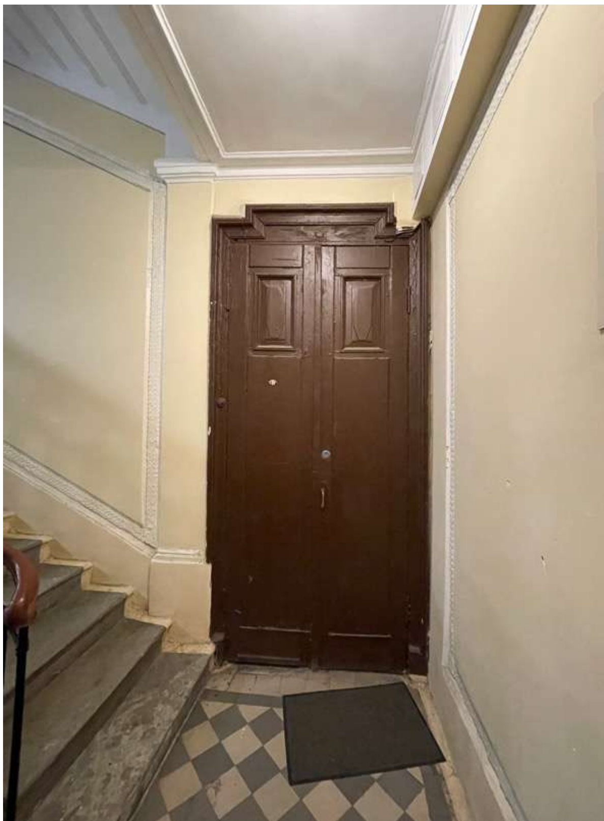
64. Фрагмент интерьера лестницы 4ЛК
