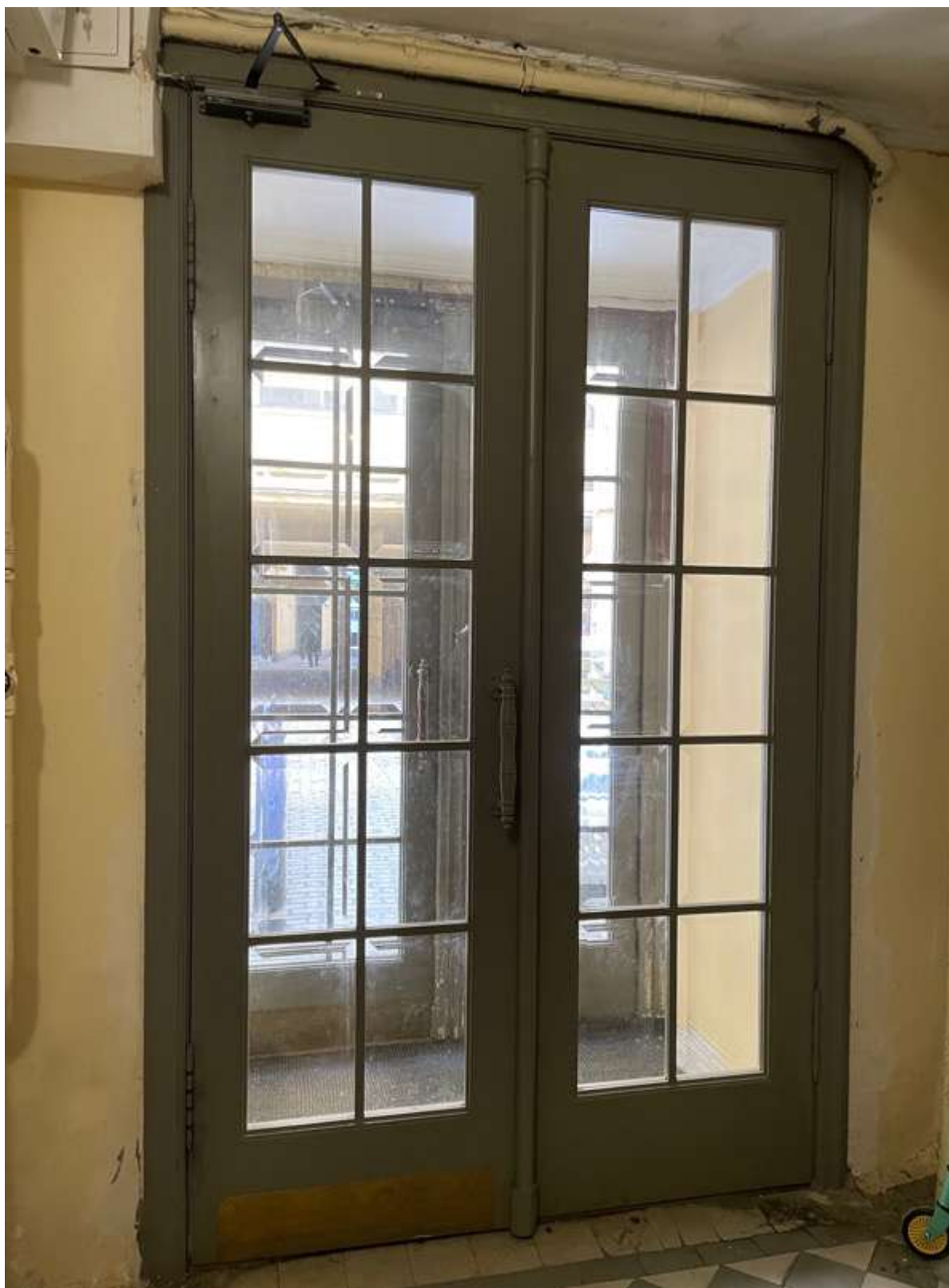
66. Фрагмент интерьера лестницы 4ЛК
