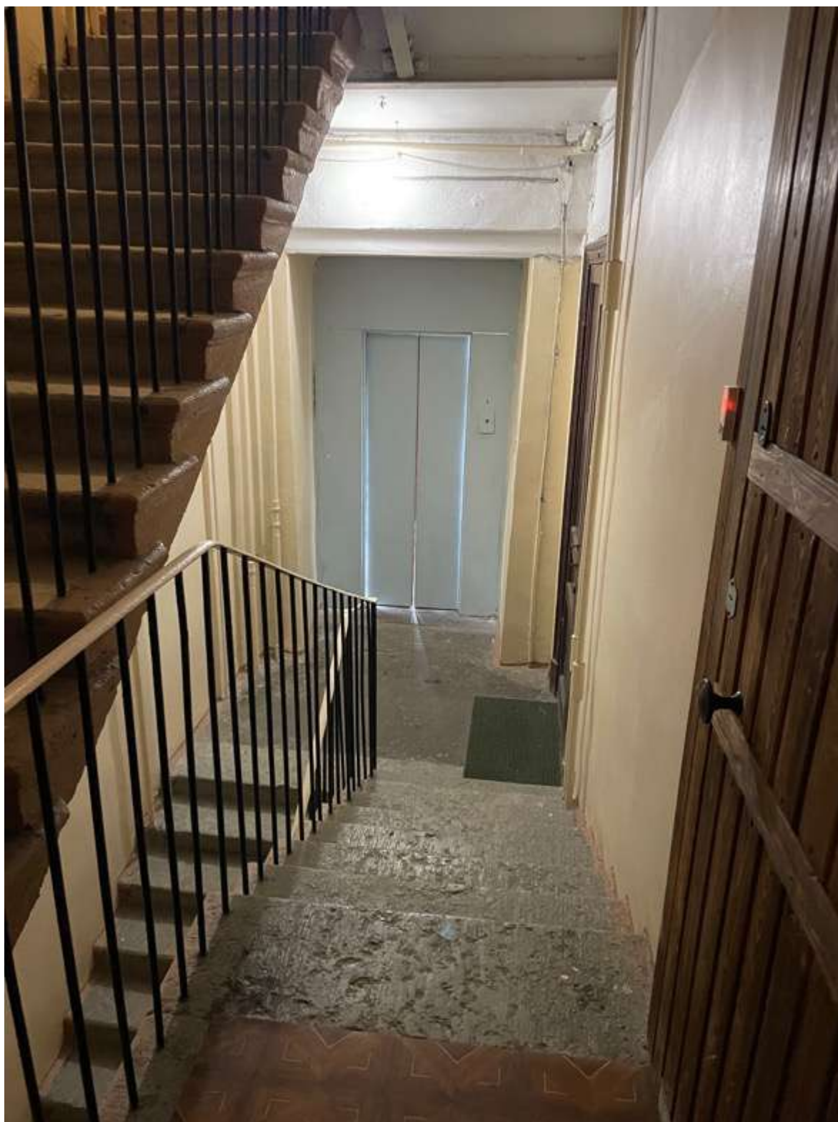
36. Фрагмент интерьера лестницы 5ЛК
