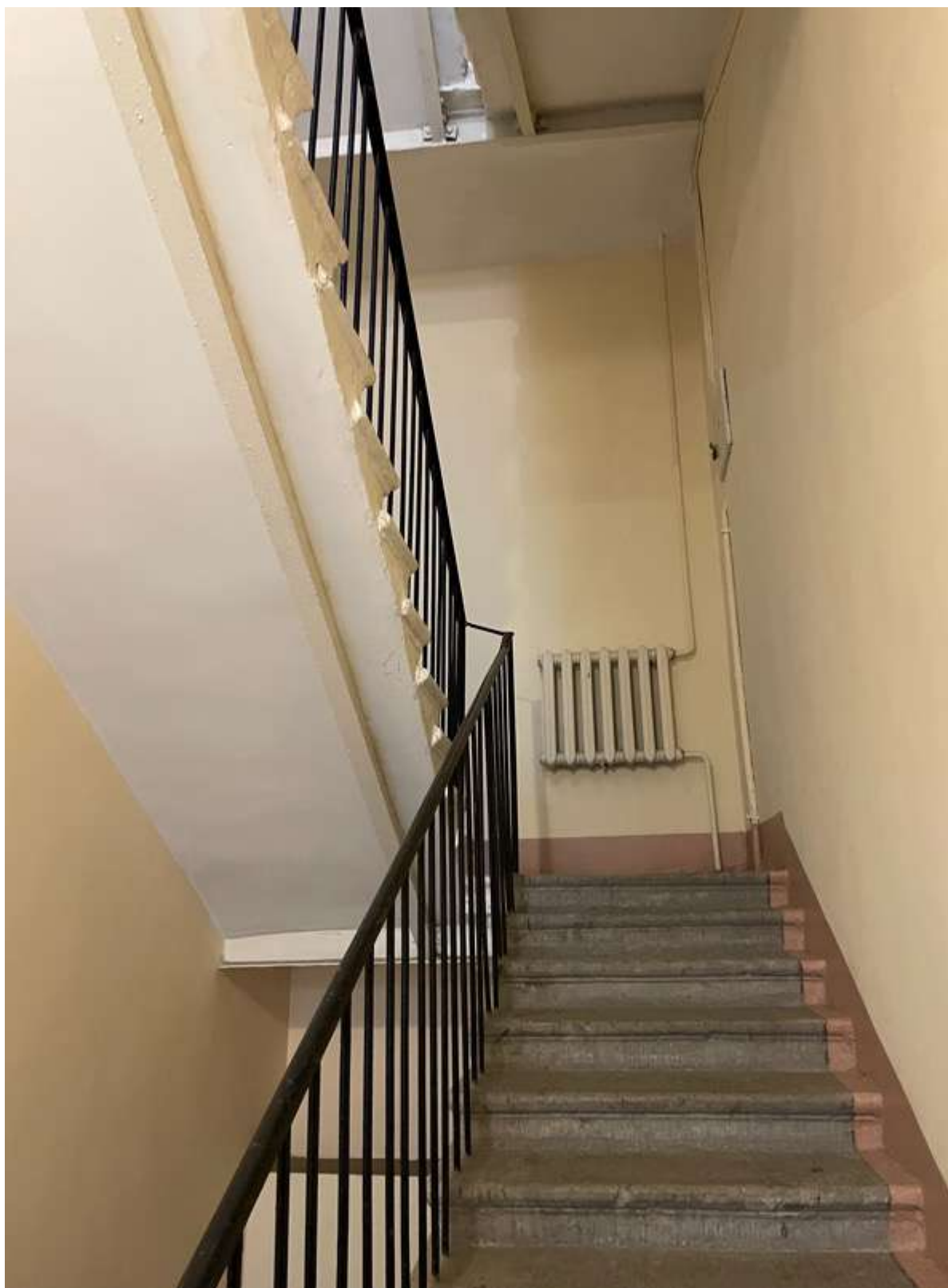
68. Фрагмент интерьера лестницы ЗЛК
