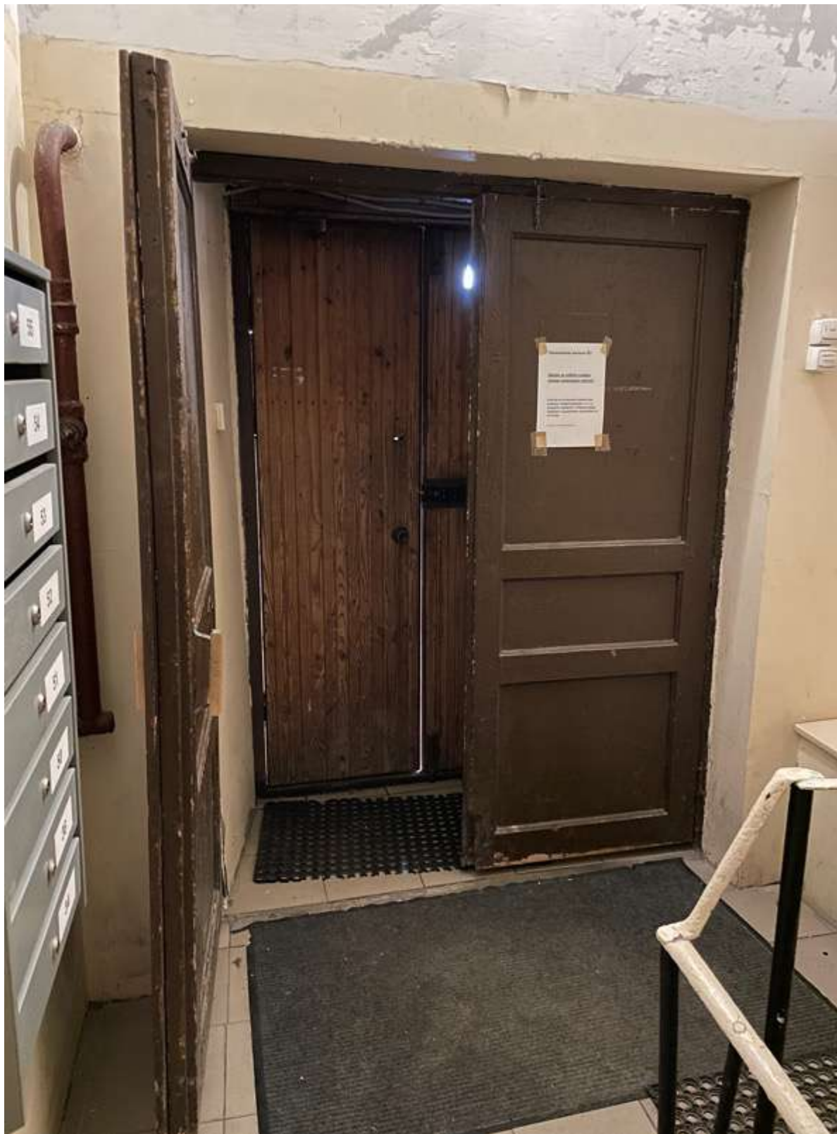
48. Фрагмент интерьера лестницы 5ЛК
