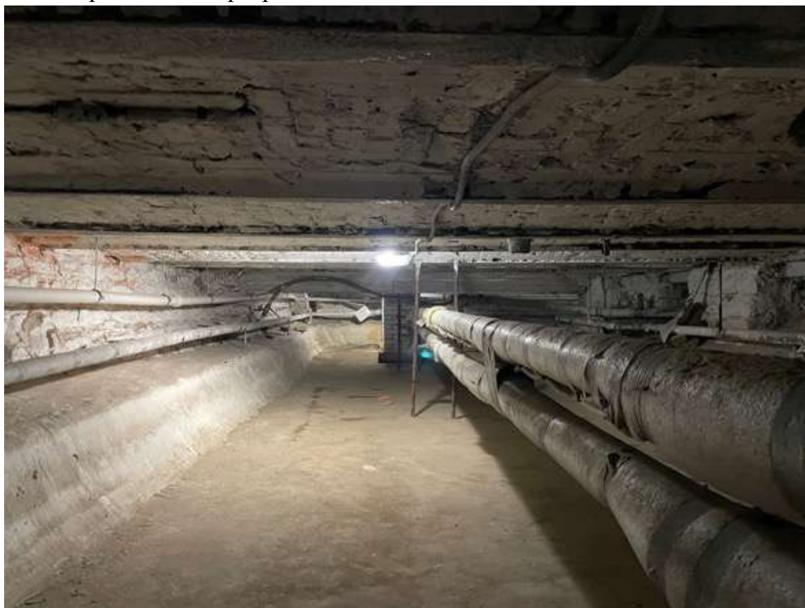
25. Фрагмент интеръера подвала
