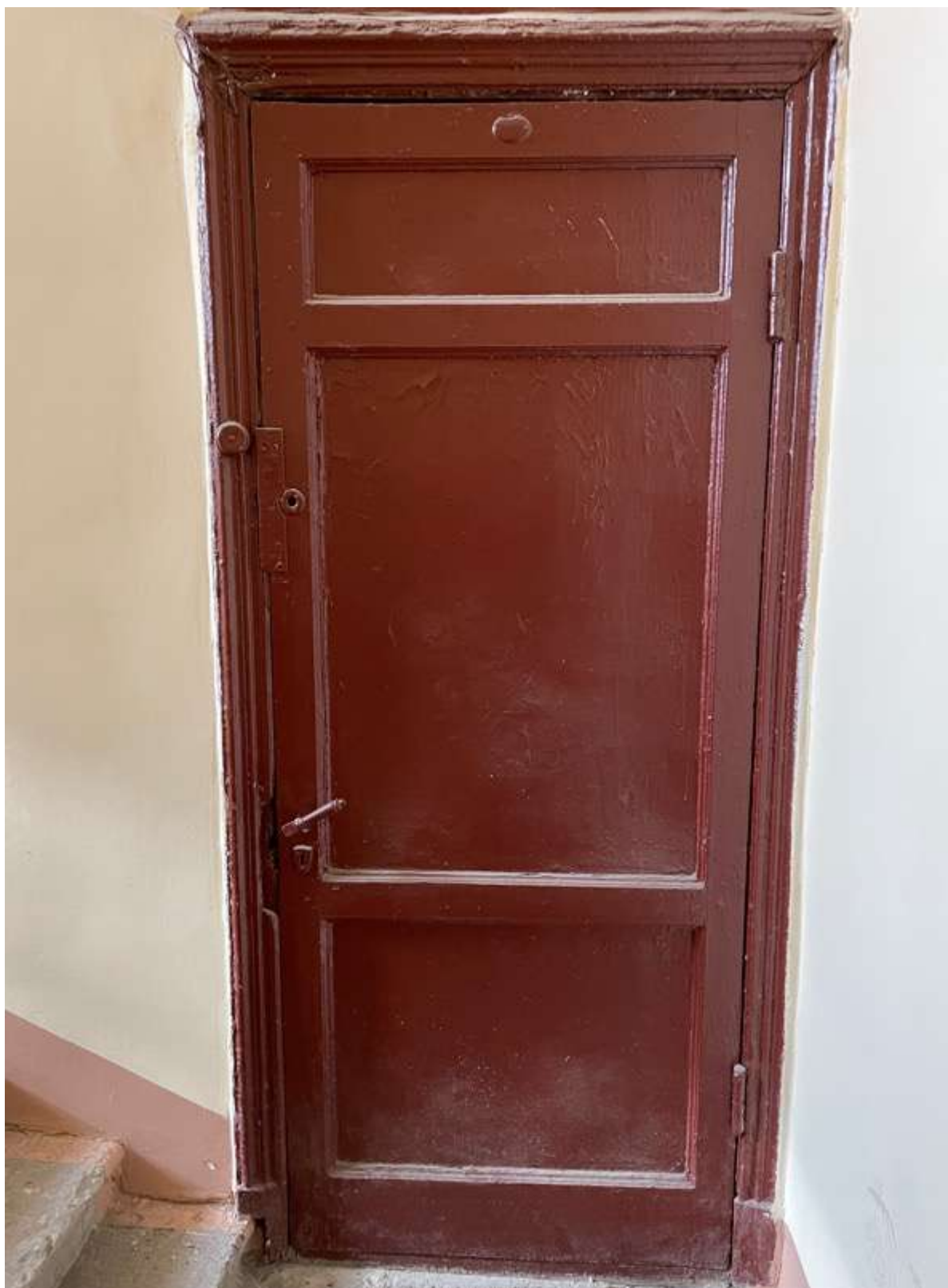
71. Фрагмент интерьера лестницы ЗЛК
