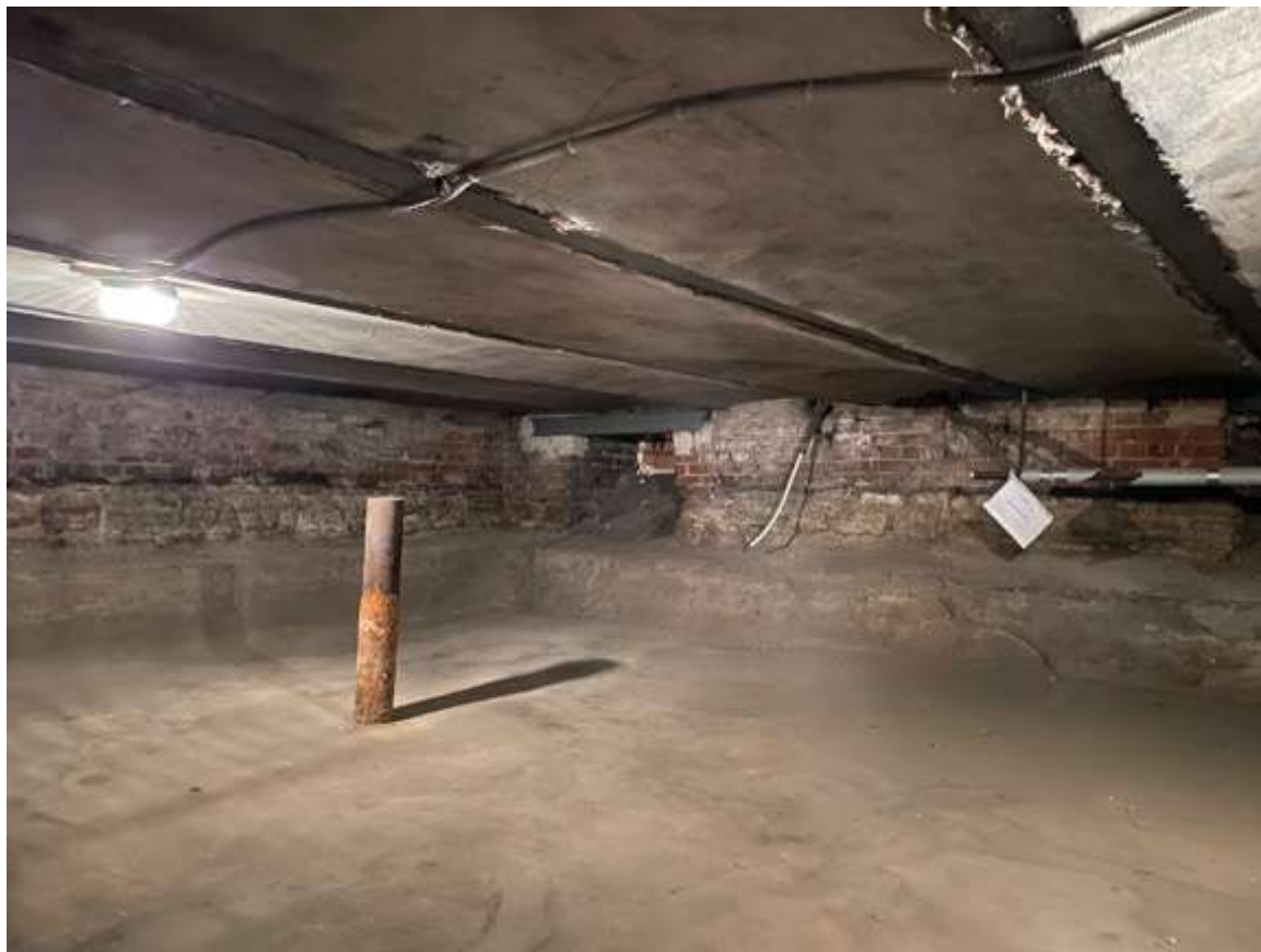
24. Фрагмент интеръера подвала
