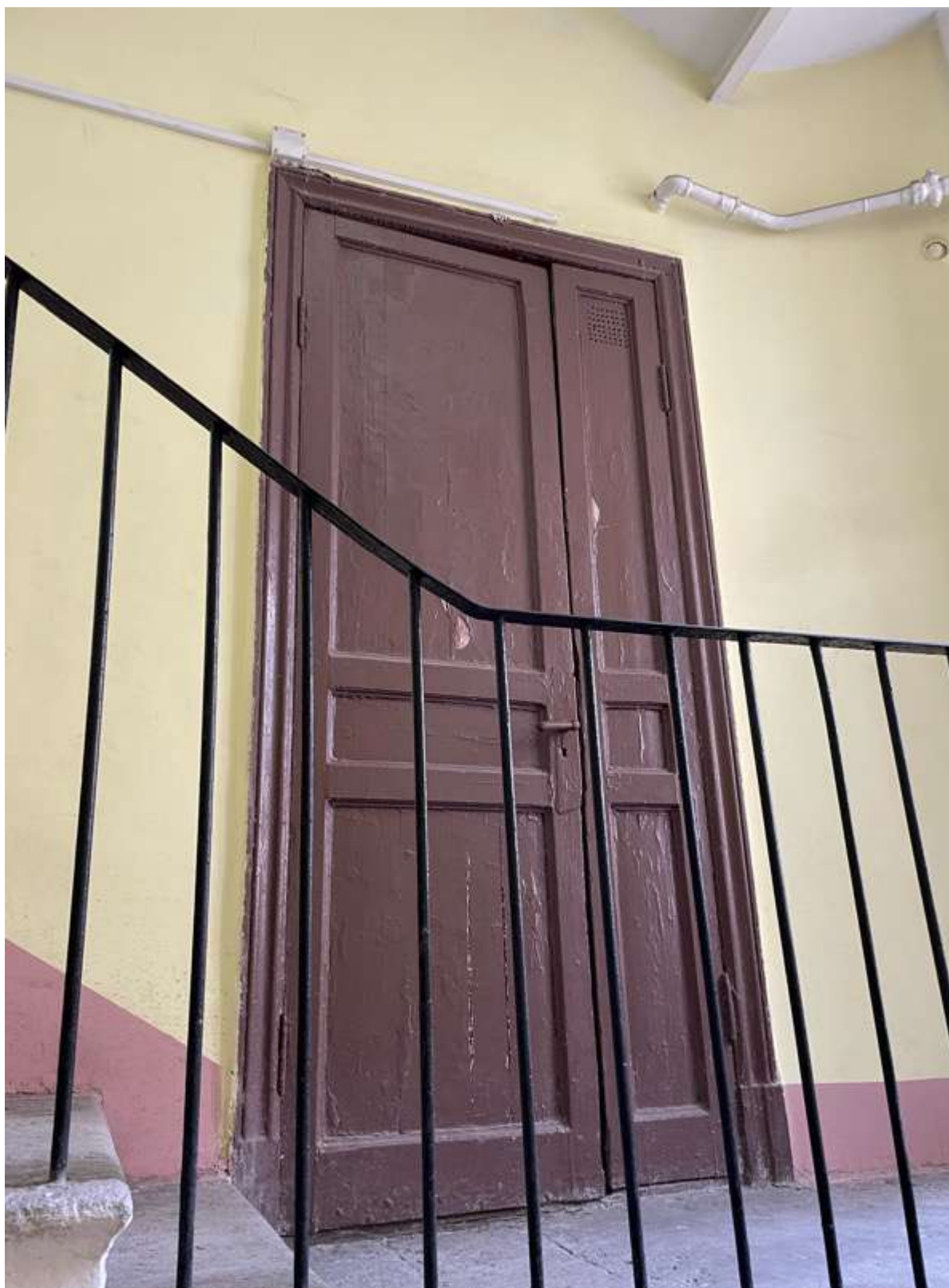
93. Фрагмент интерьера лестницы 2ЛК
