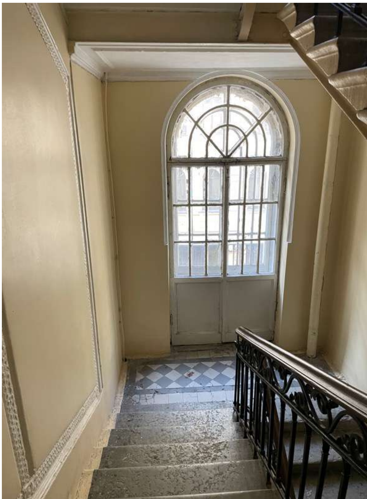
60. Фрагмент интерьера лестницы 4ЛК
