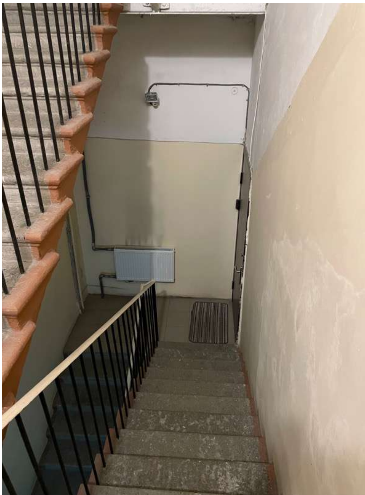
43. Фрагмент интерьера лестницы 5ЛК
