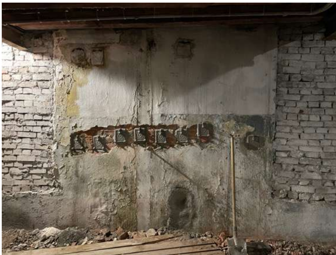
31. Фрагмент интерьера чердака
