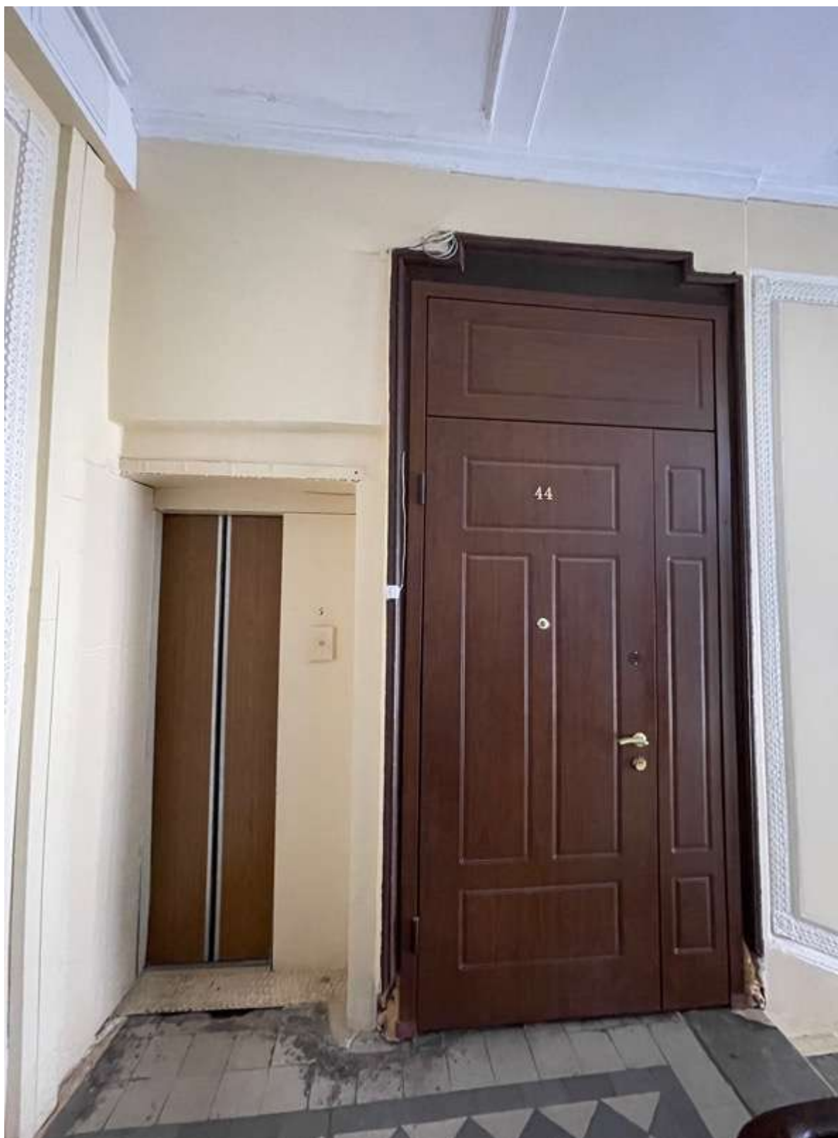
54. Фрагмент интерьера лестницы 4ЛК
