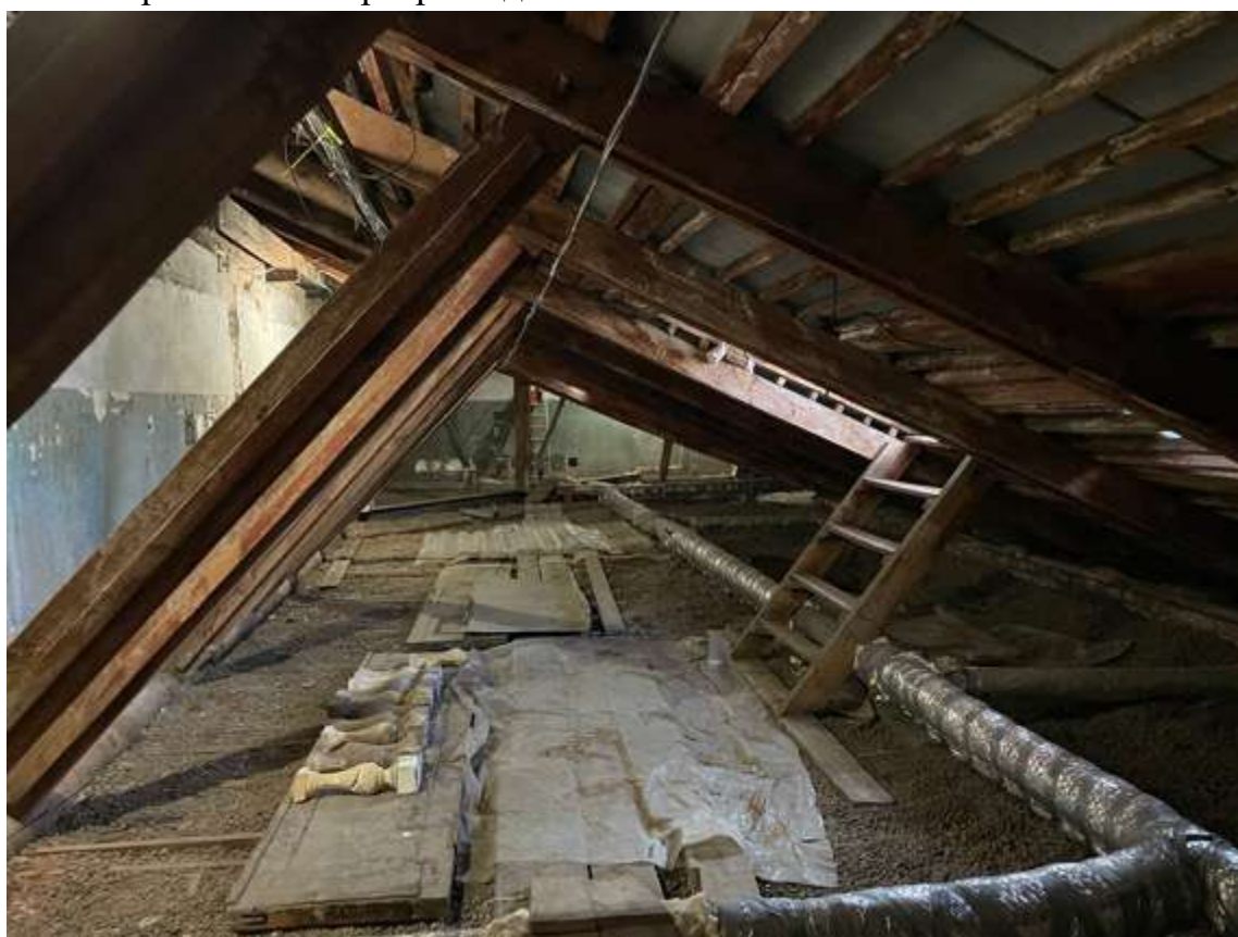
27. Фрагмент интерьера чердака
