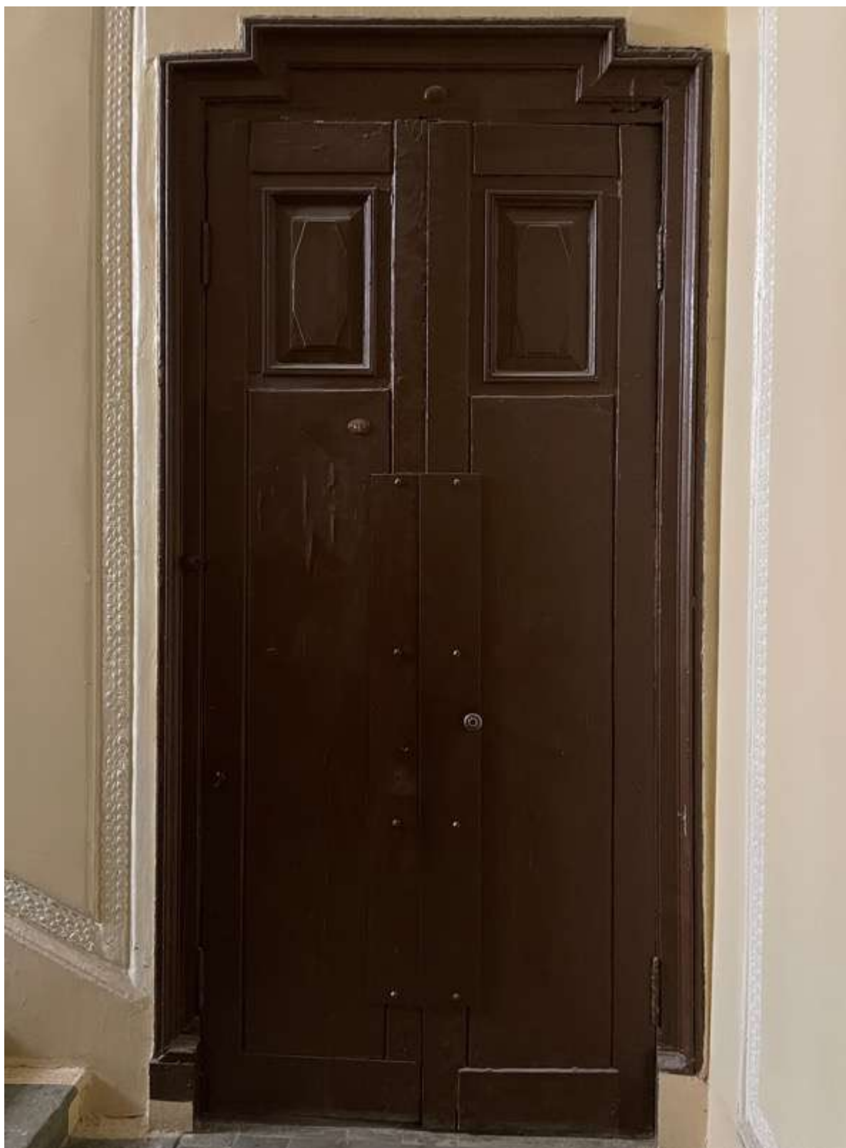
61. Фрагмент интерьера лестницы 4ЛК
