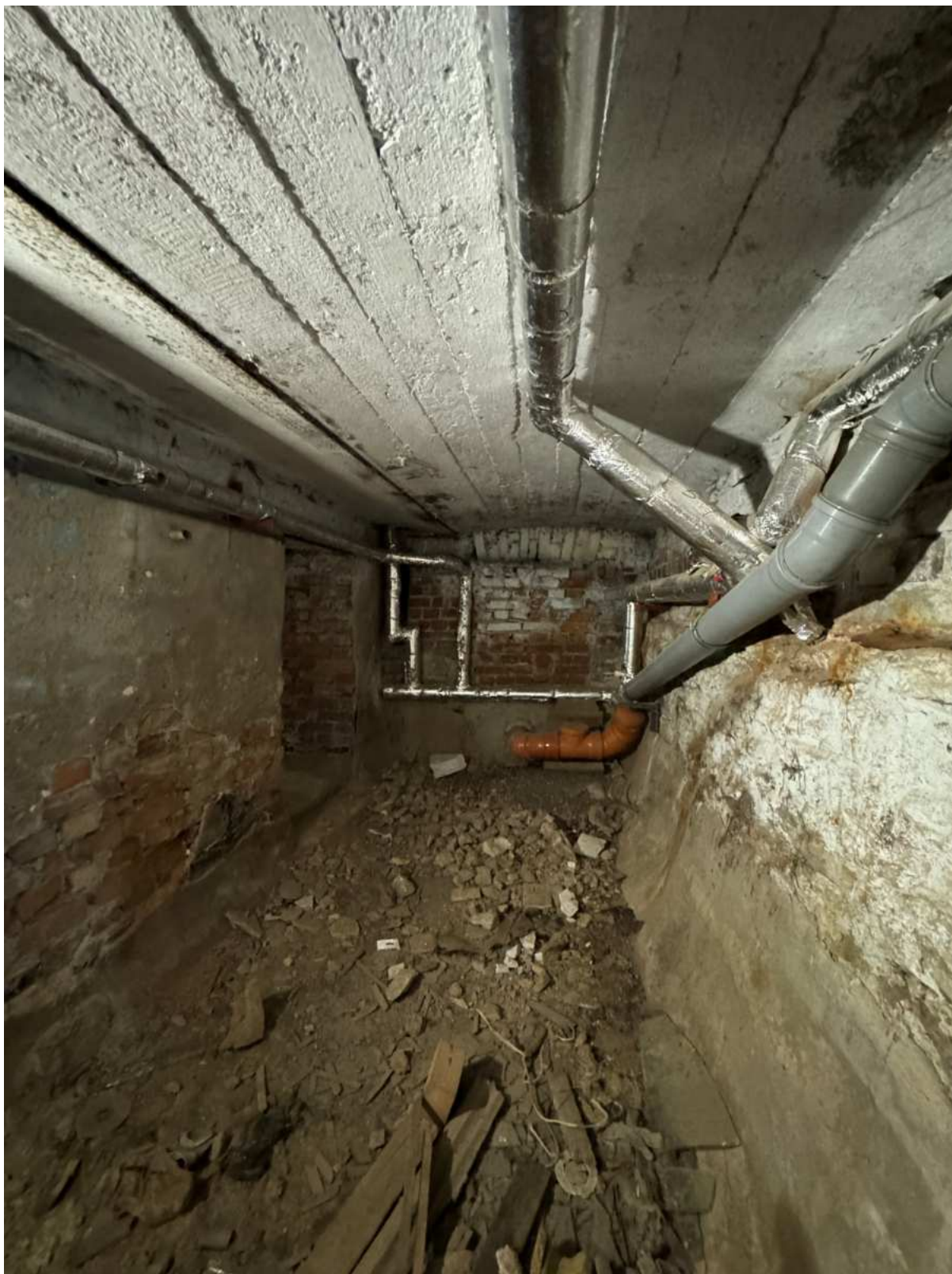
83. Подвальные помещения в части лестницы 5ЛК объекта культурного наследия.
