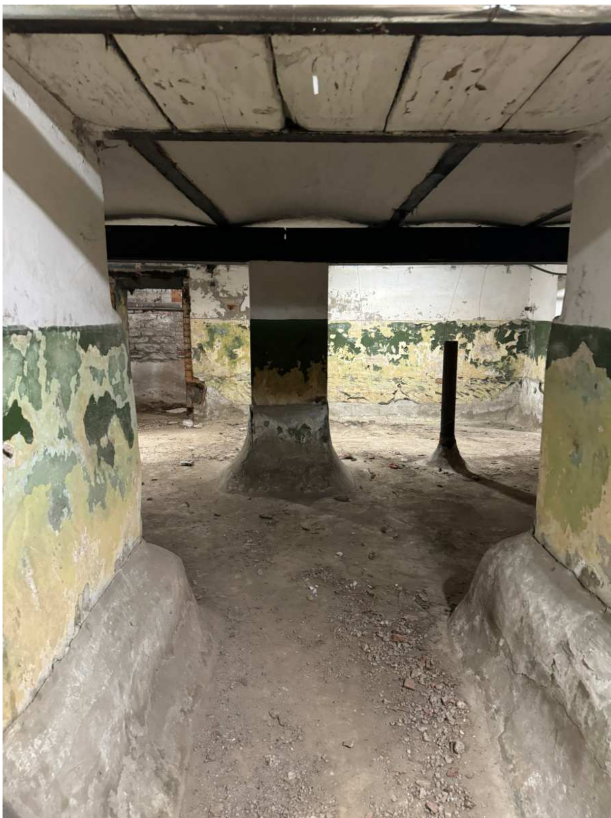
84. Подвальные помещения в части лестницы 5ЛК объекта культурного наследия.
