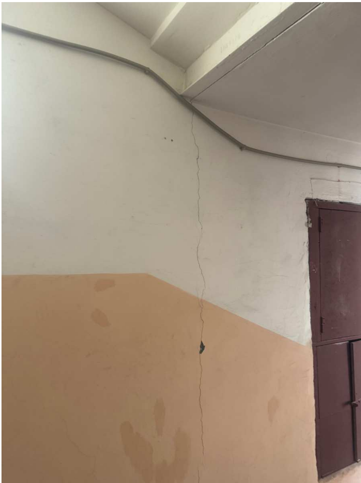
100. Фрагмент стены в части лестницы 4ЛК объекта культурного наследия.
