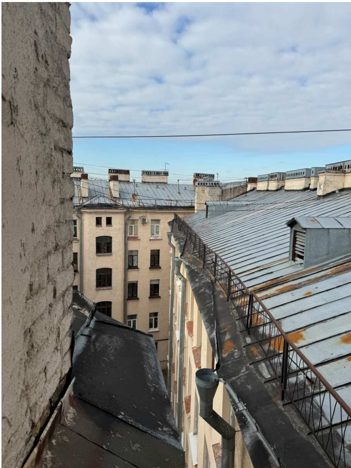
15. Вид на крышу и часть дворовых фасадов объекта культурного наследия.
