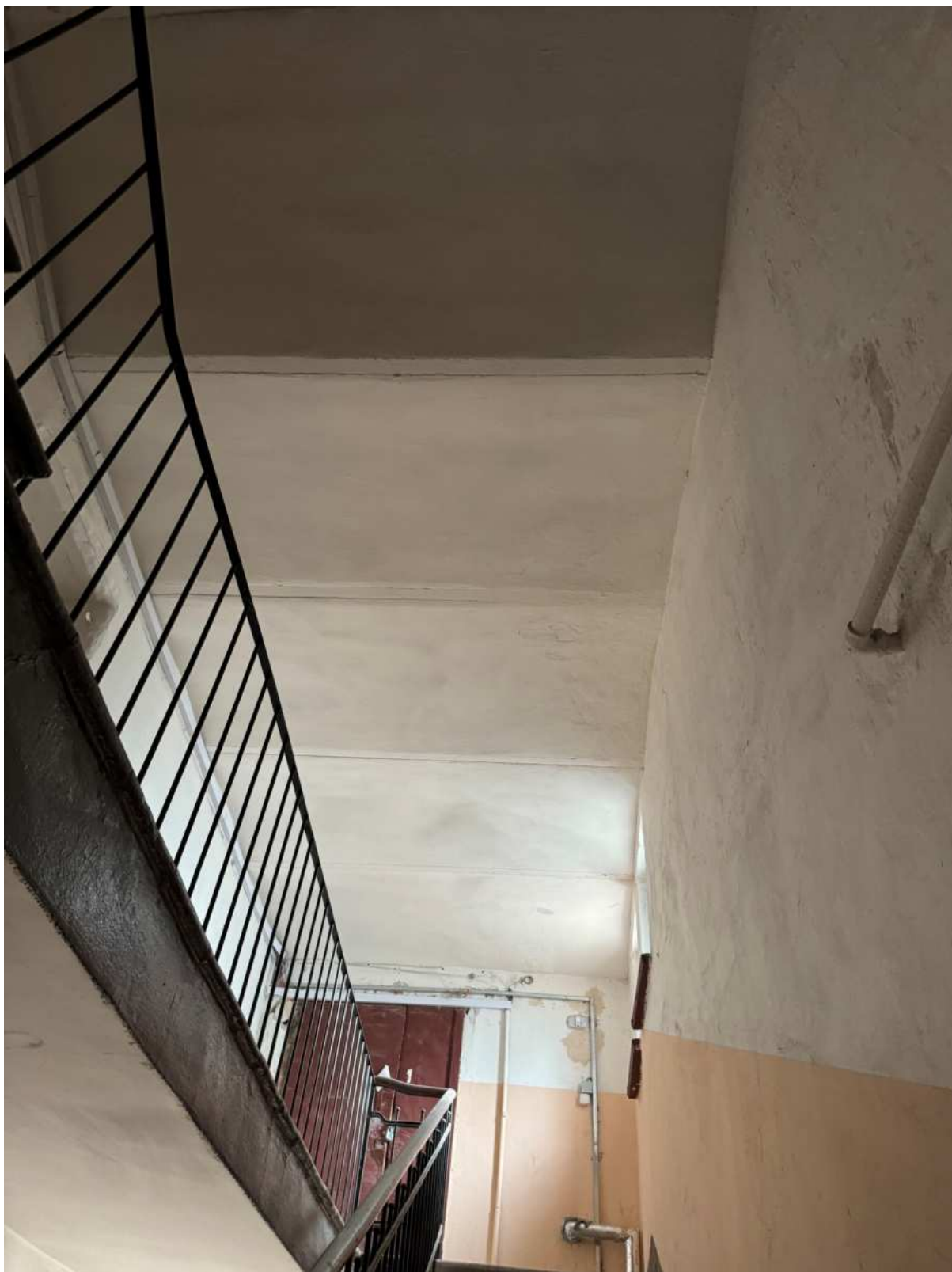
60. Интерьеры в части лестницы ЗЛК объекта культурного наследия.
