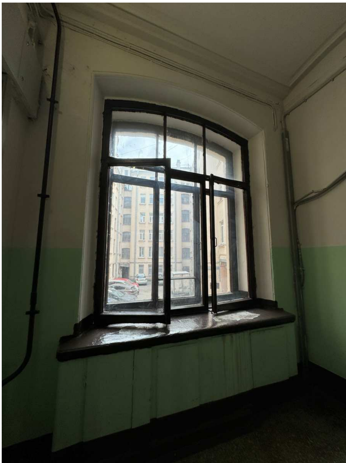
47. Оконное заполнение в части лестницы 2ЛК объекта культурного наследия.
