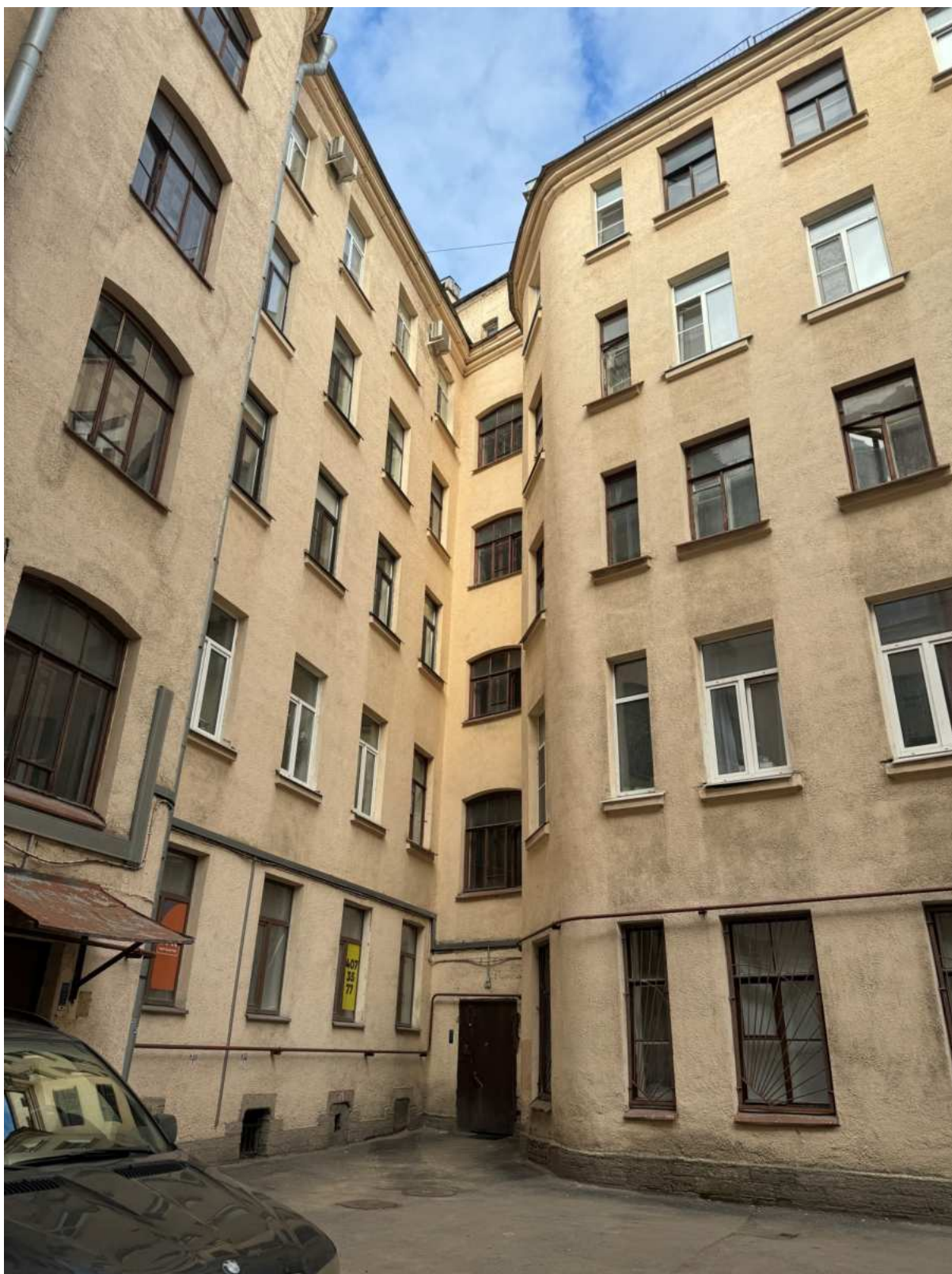
10. Общий вид дворовых фасадов объекта культурного наследия.
