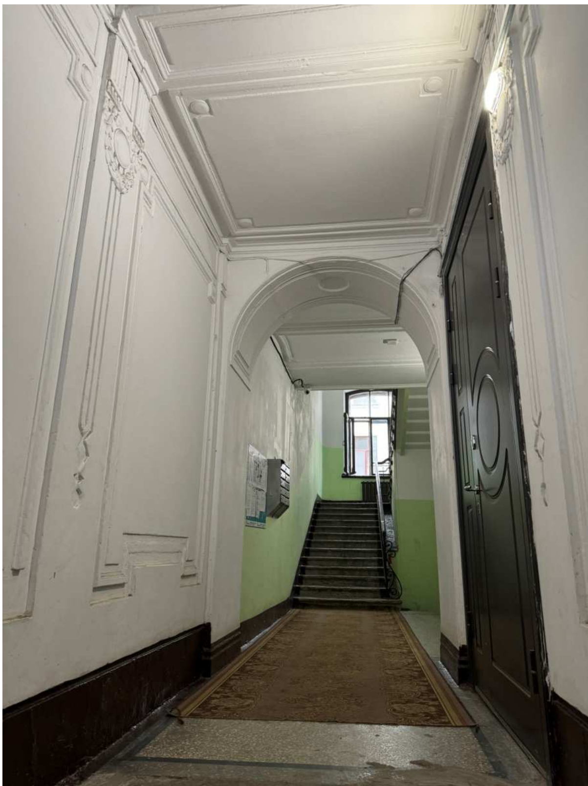
89. Интерьеры в части лестницы БЛК объекта культурного наследия.
