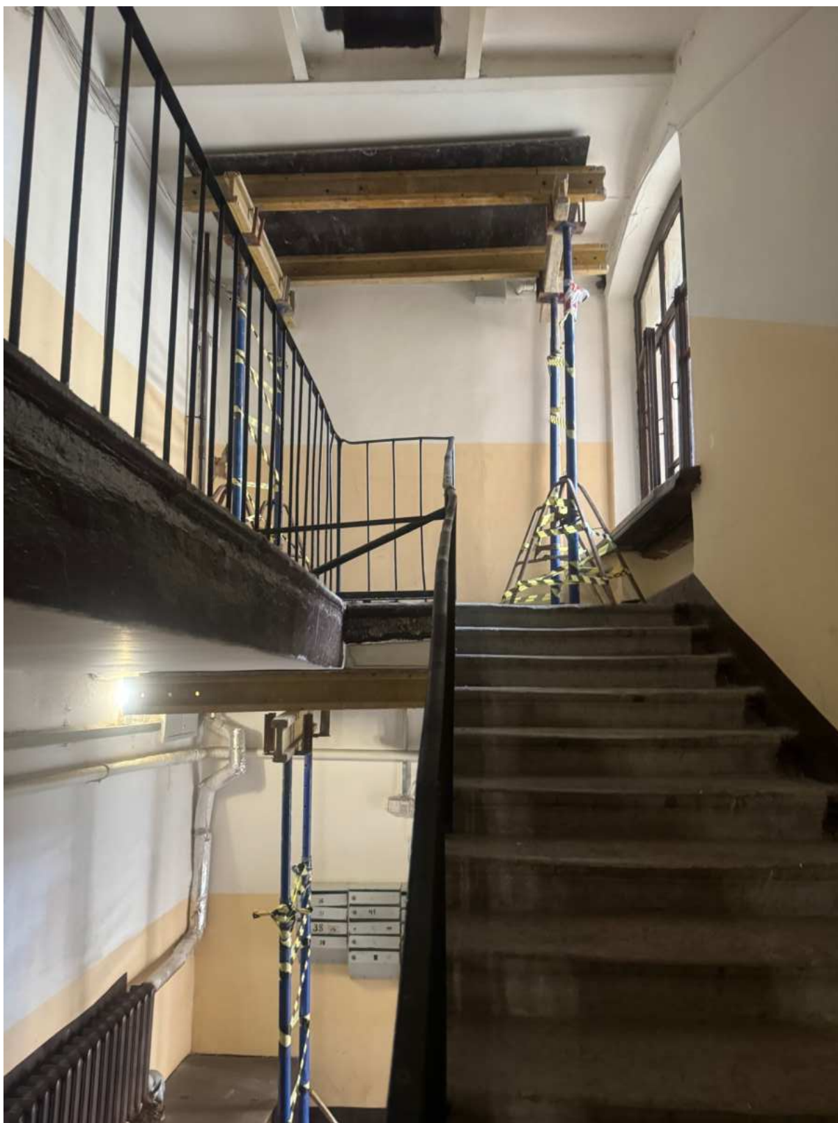
104. Интерьеры в части лестницы 4ЛК объекта культурного наследия.
