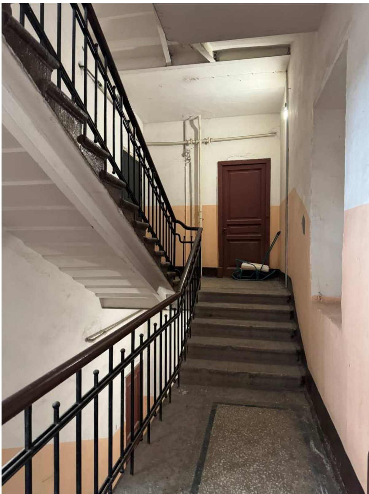
58. Интерьеры в части лестницы ЗЛК объекта культурного наследия.
