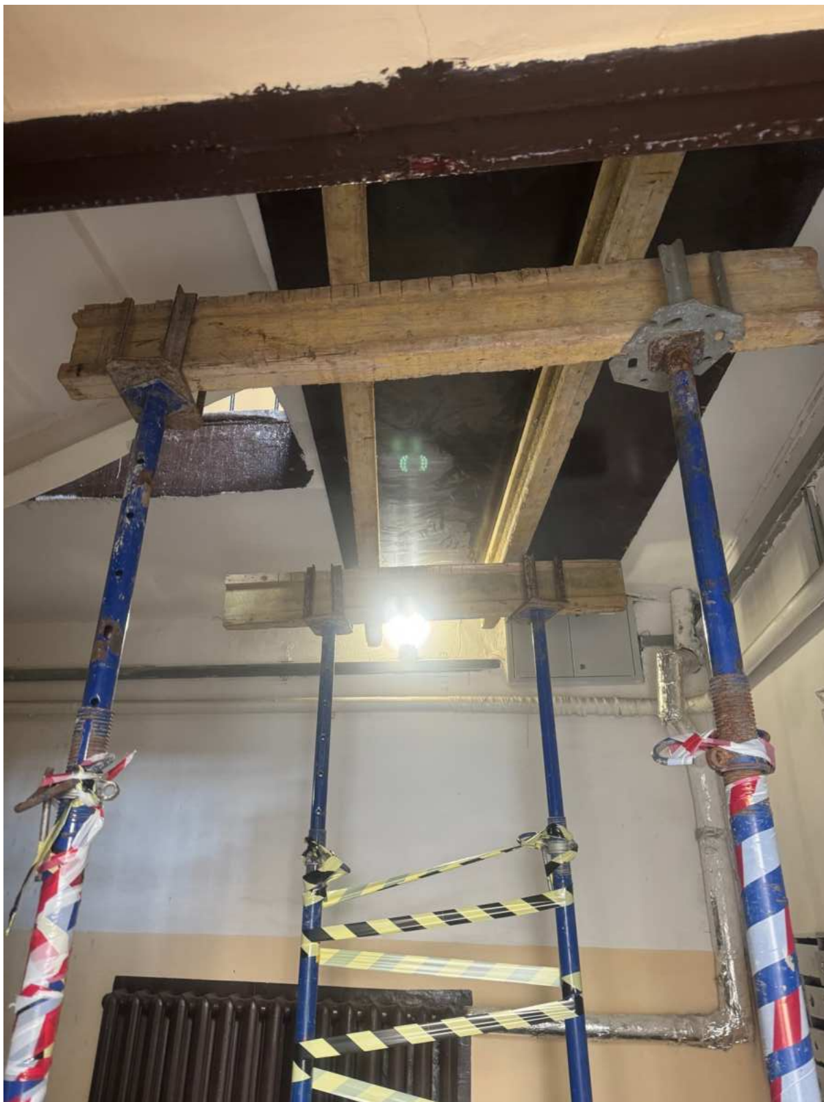
102. Подпорные элементы конструкций в части лестницы 4ЛК объекта культурного наследия.
