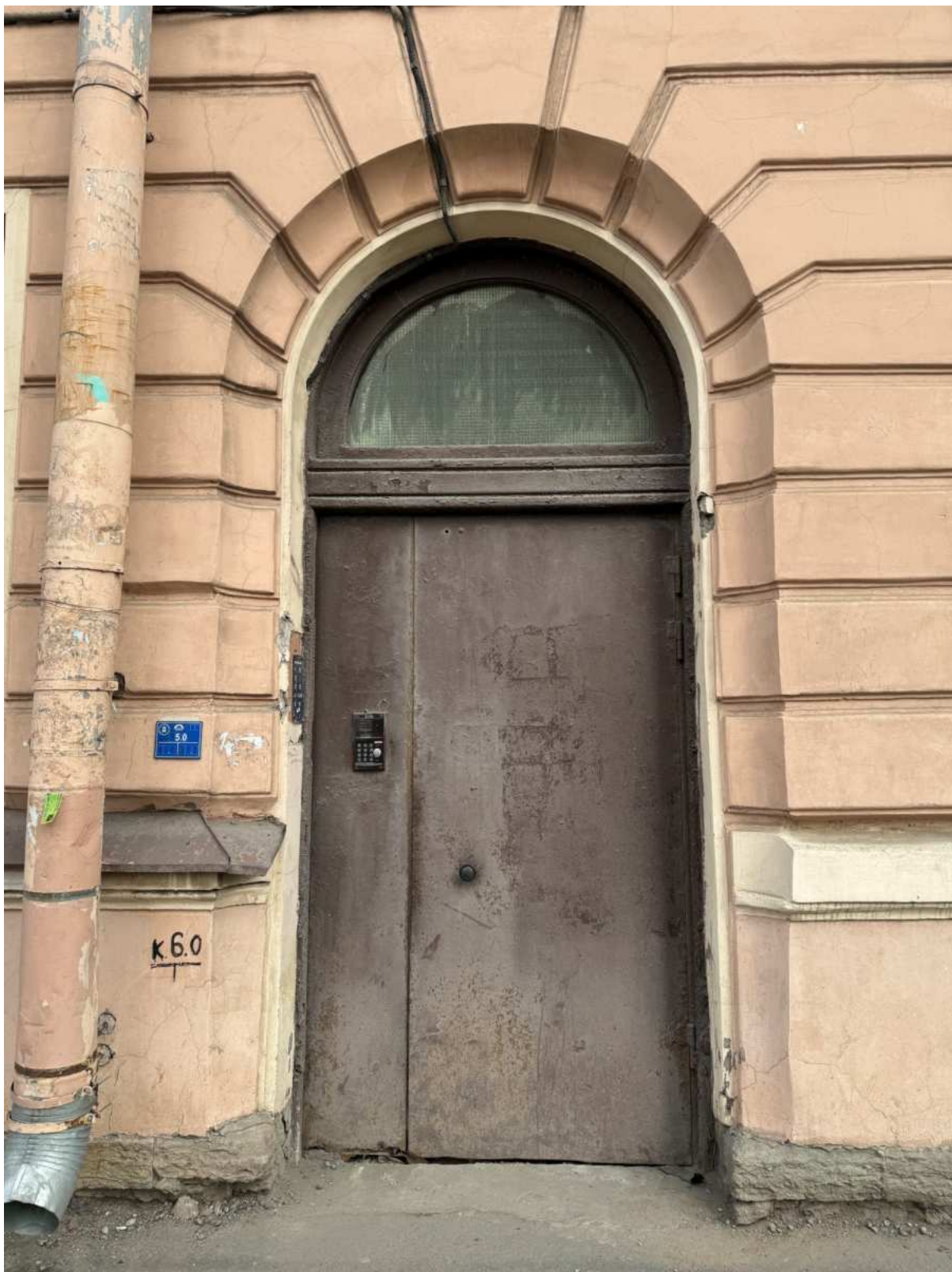
17. Вход с лицевого фасада по 8-й линии В.О. в помещения лестницы 1ЛК объекта культурного наследия.
