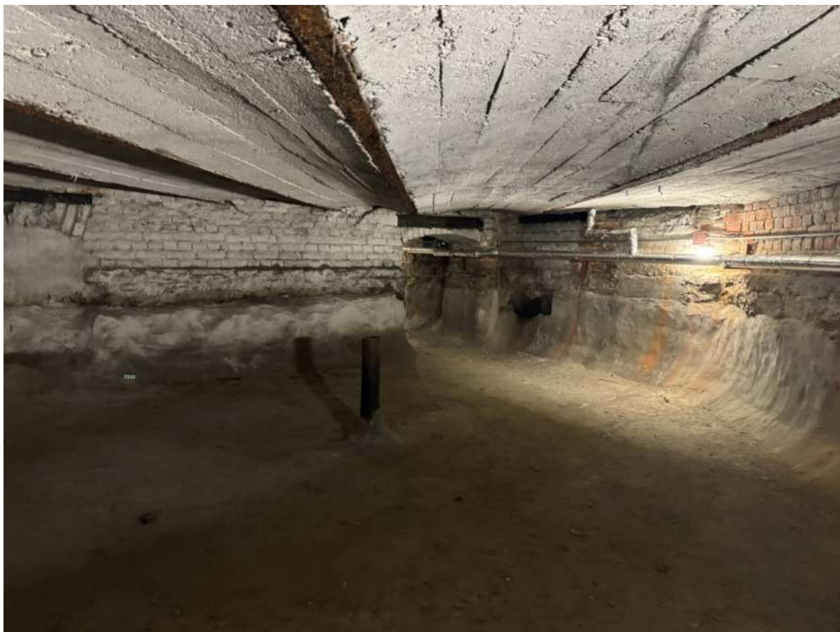
41. Подвальные помещения в части лестницы 2ЛК объекта культурного наследия.
