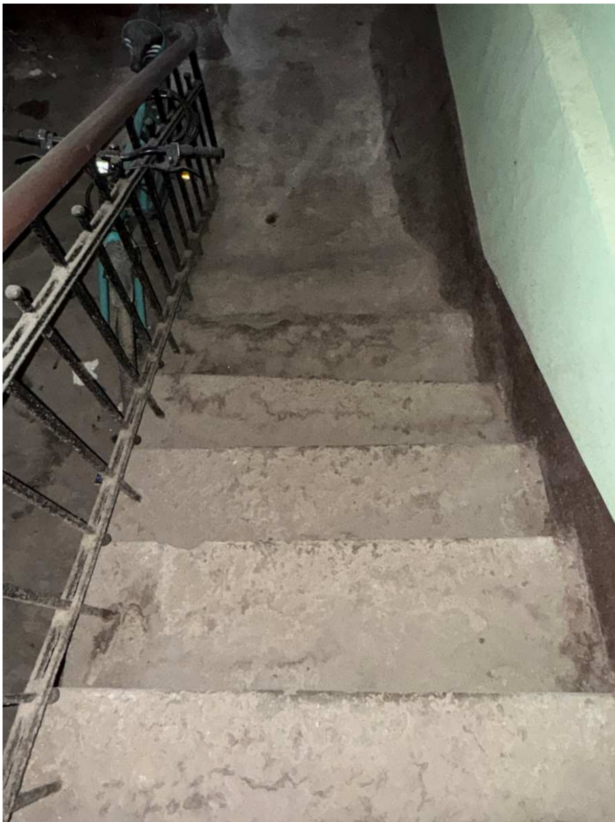
39. Ведущая в подвал часть лестницы 2ЛК объекта культурного наследия.
