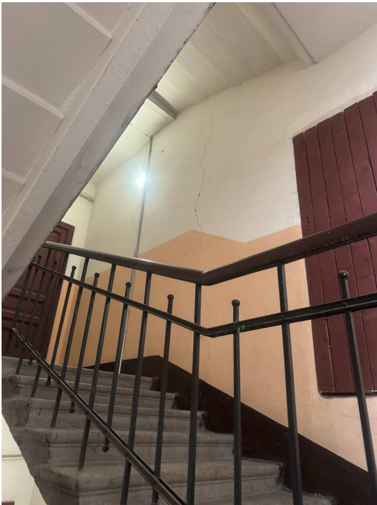
99. Интерьеры в части лестницы 4ЛК объекта культурного наследия.
