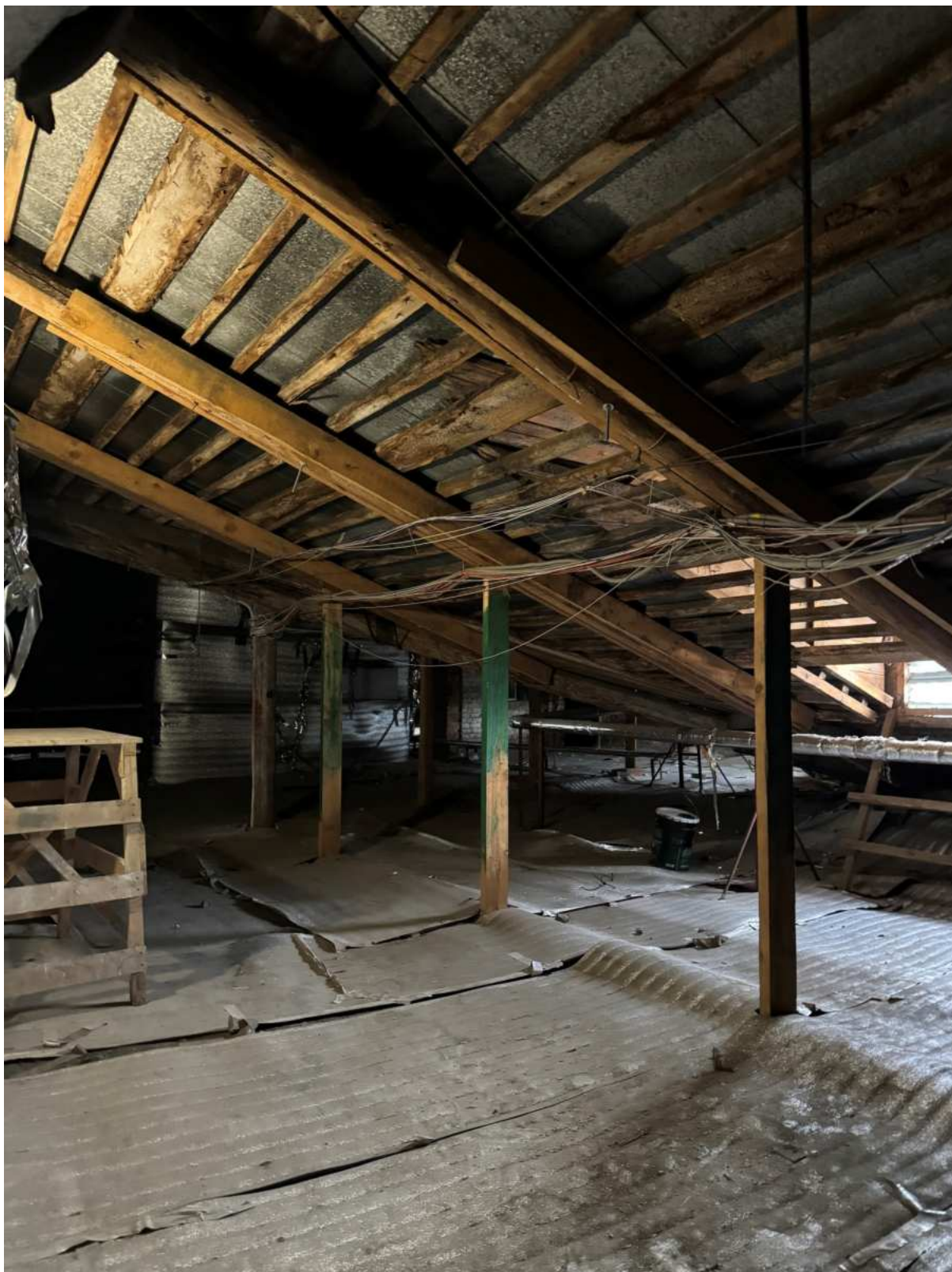
30. Чердачные помещения в части лестницы 1ЛК объекта культурного наследия.
