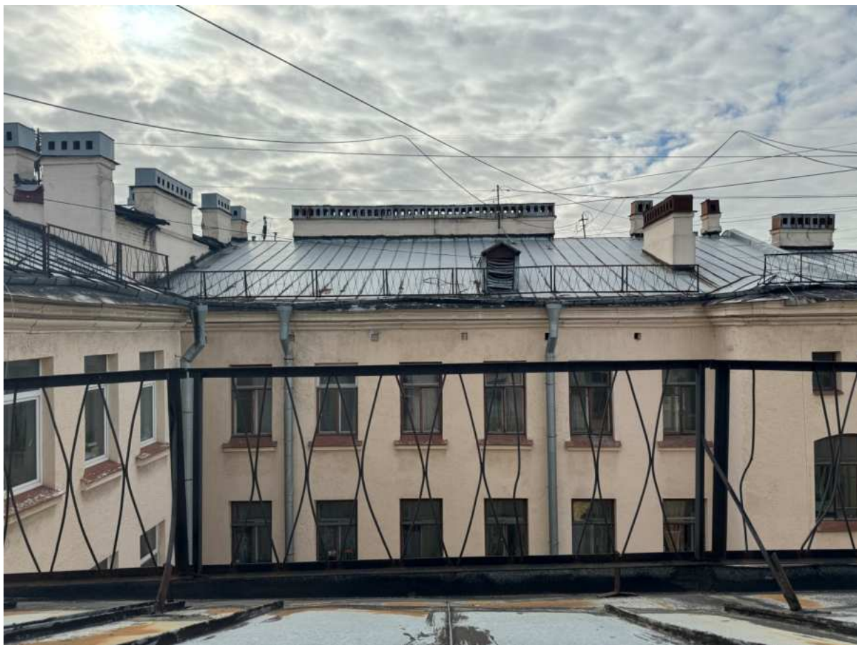
14. Вид на крышу и часть дворовых фасадов объекта культурного наследия.
