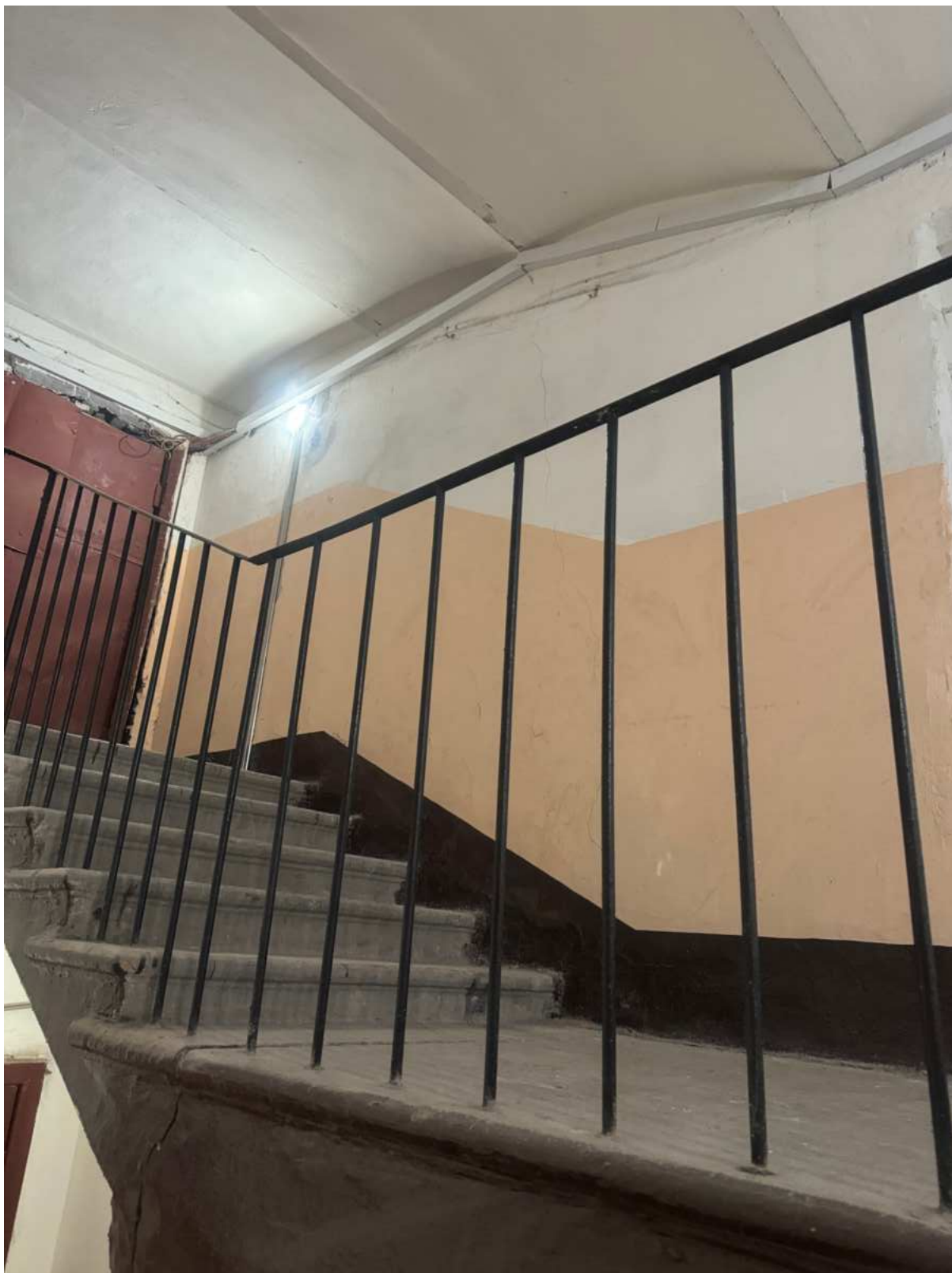
101. Интерьеры в части лестницы 4ЛК объекта культурного наследия.
