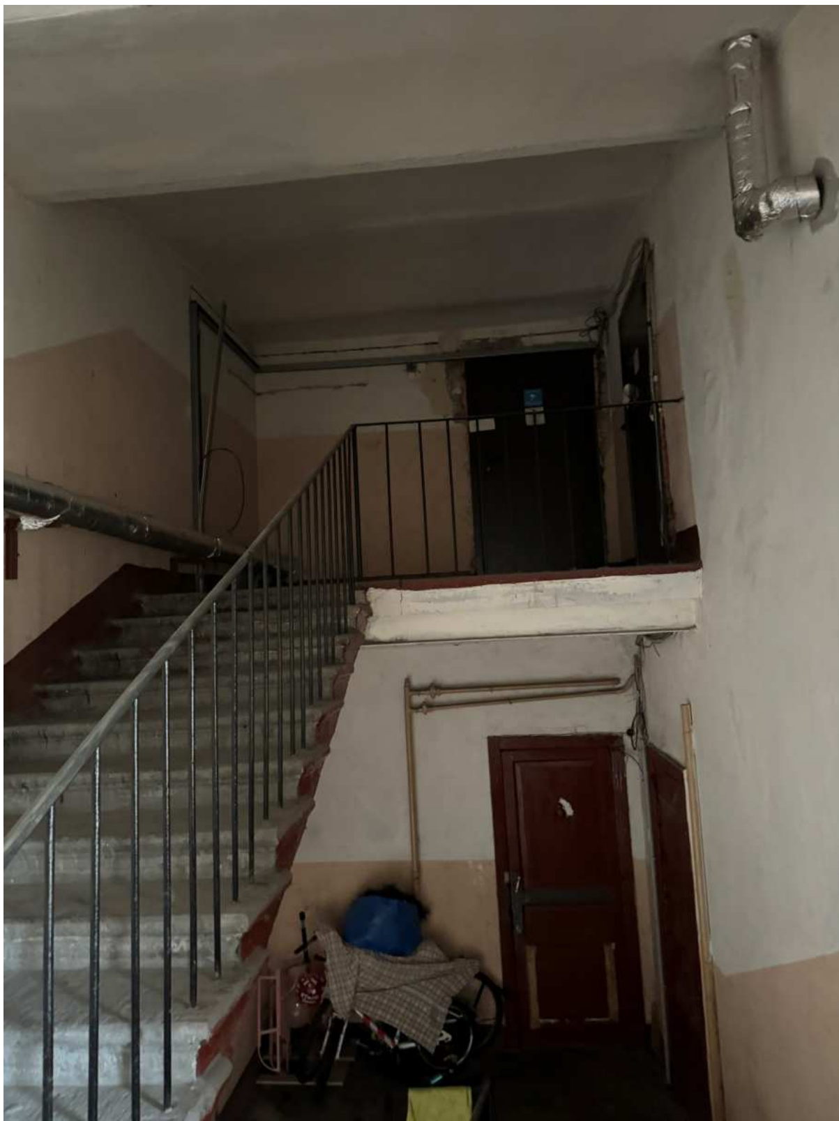
82. Интерьеры в части лестницы 5ЛК объекта культурного наследия.
