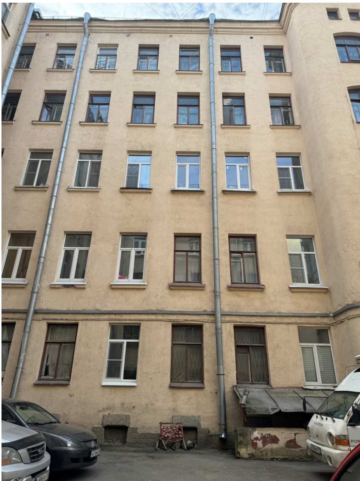
11. Общий вид дворовых фасадов объекта культурного наследия.
