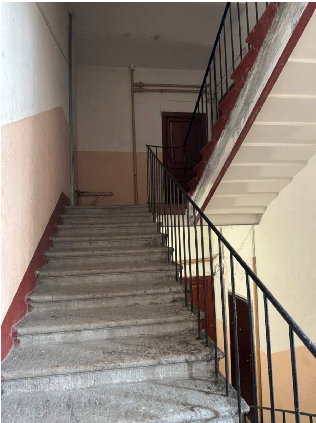
80. Интерьеры в части лестницы 5ЛК объекта культурного наследия.
