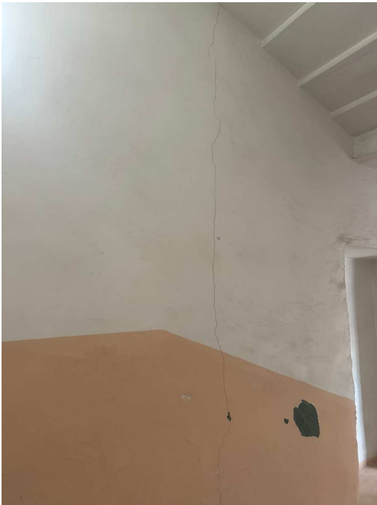
98. Фрагмент стены в части лестницы 4ЛК объекта культурного наследия.
