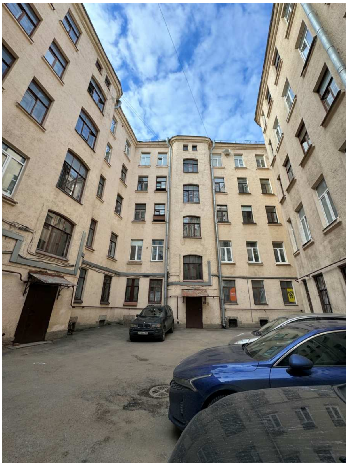
9. Общий вид дворовых фасадов объекта культурного наследия.
