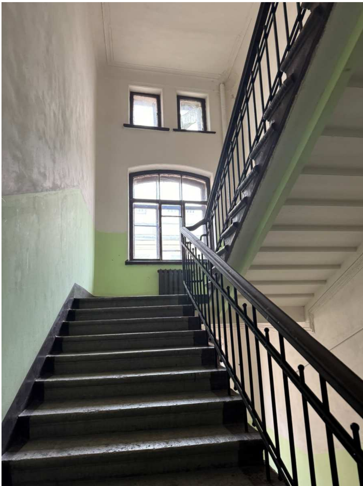
96. Интерьеры в части лестницы БЛК объекта культурного наследия.
