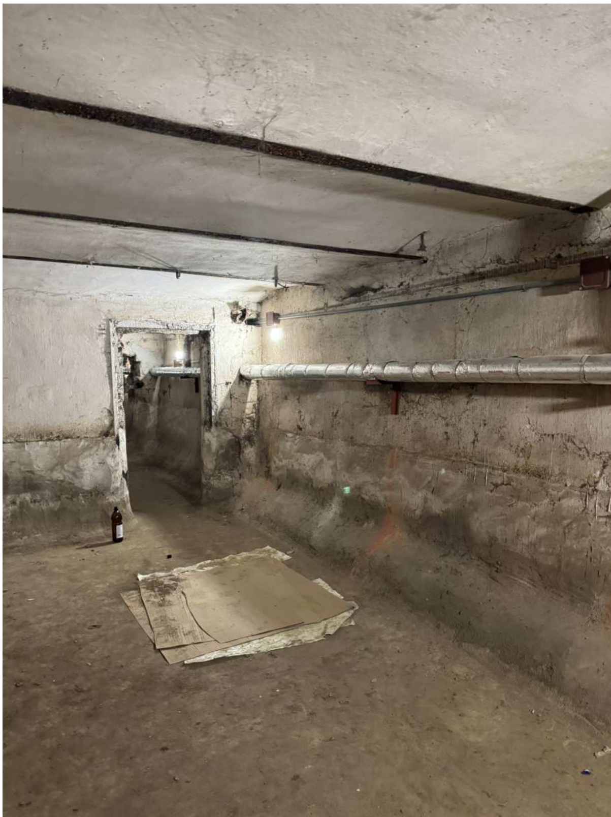
40. Подвальные помещения в части лестницы 2ЛК объекта культурного наследия.
