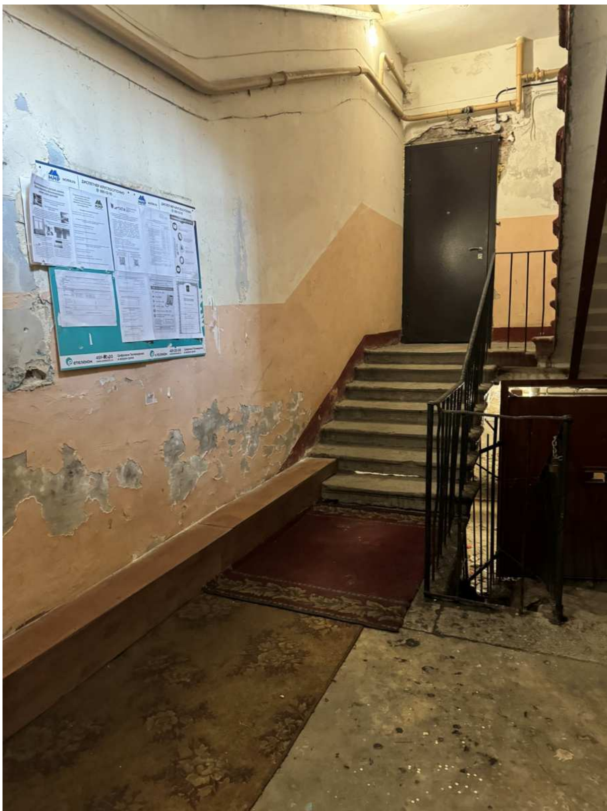
72. Интерьеры в части лестницы 5ЛК объекта культурного наследия.
