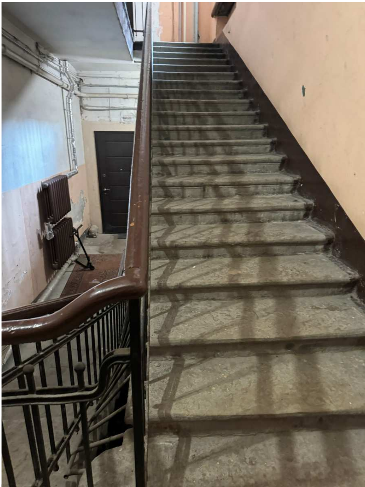
54. Интерьеры в части лестницы ЗЛК объекта культурного наследия.
