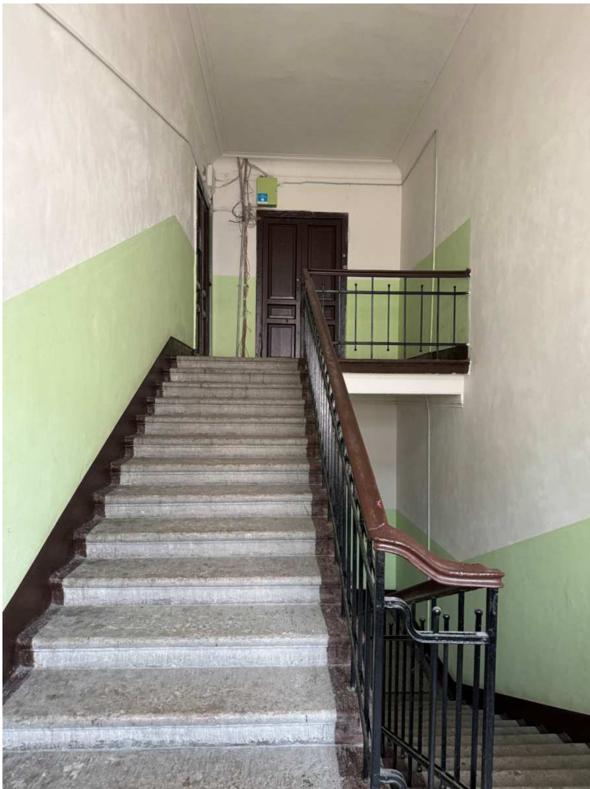
97. Интерьеры в части лестницы БЛК объекта культурного наследия.
