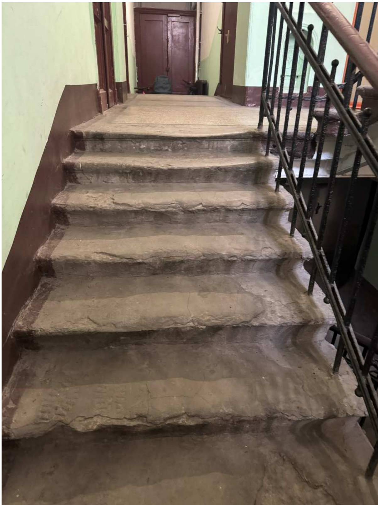
42. Интерьеры в части лестницы 2ЛК объекта культурного наследия.
