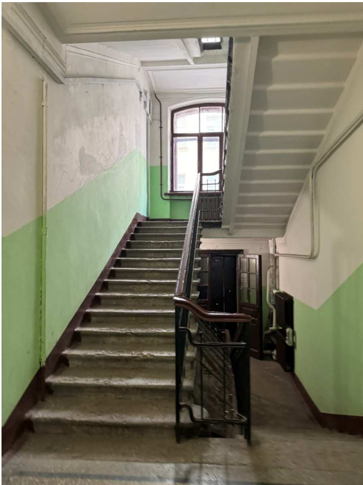
22. Интерьеры в части лестницы 1ЛК объекта культурного наследия.
