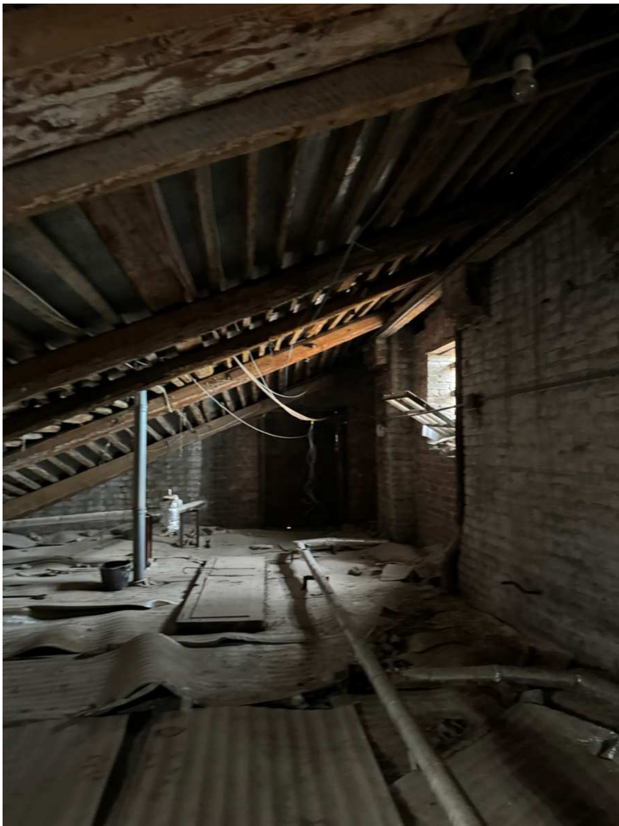
70. Чердачное помещение в части лестницы 4ЛК объекта культурного наследия.
