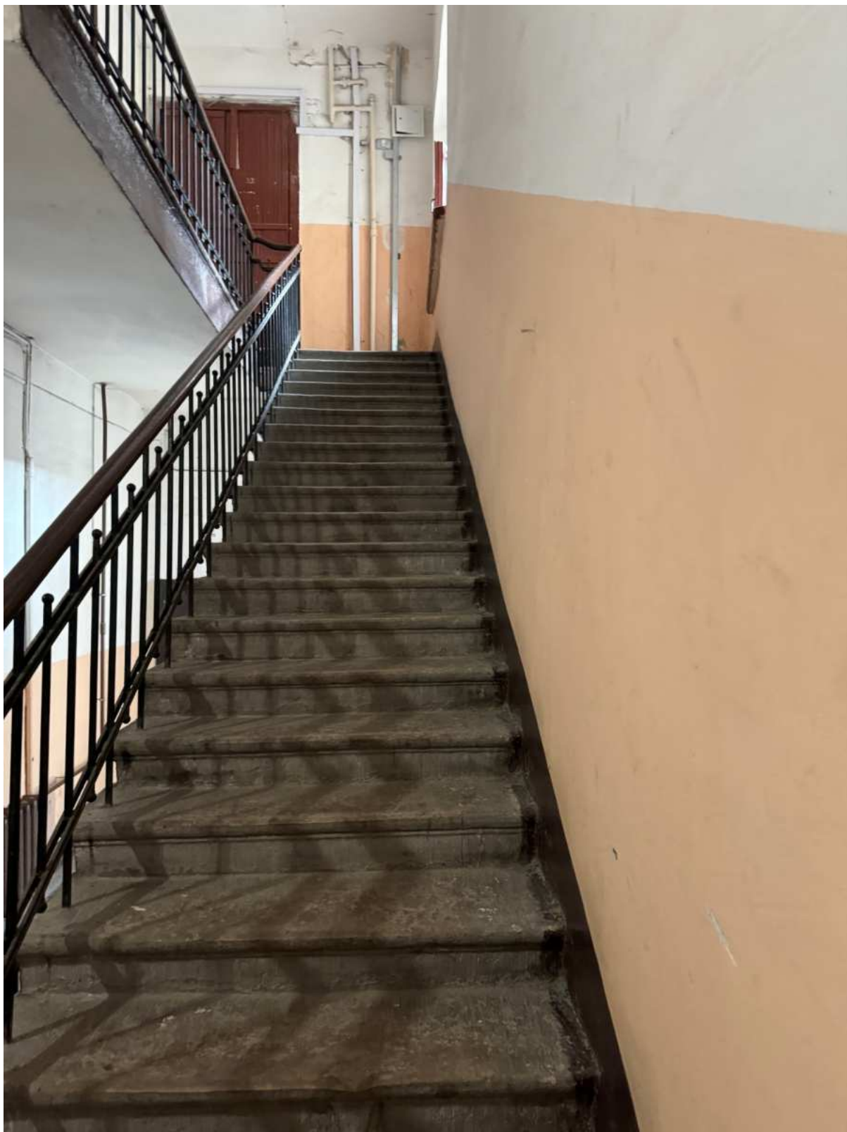
56. Интерьеры в части лестницы ЗЛК объекта культурного наследия.
