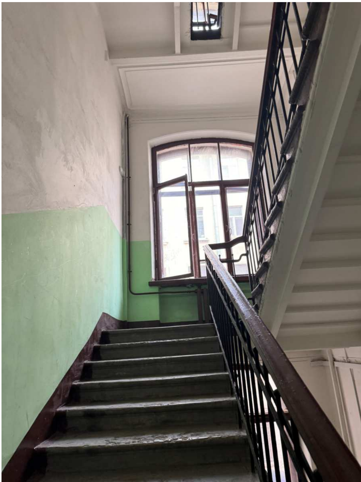
24. Интерьеры в части лестницы 1ЛК объекта культурного наследия.
