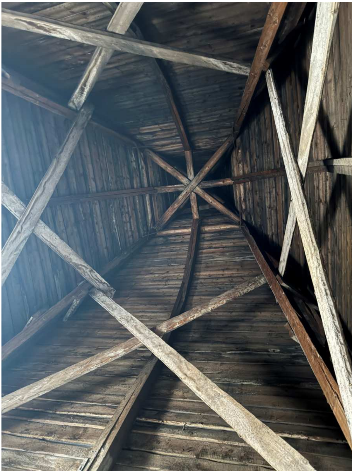
32. Чердачные помещения в части башни объекта культурного наследия.
