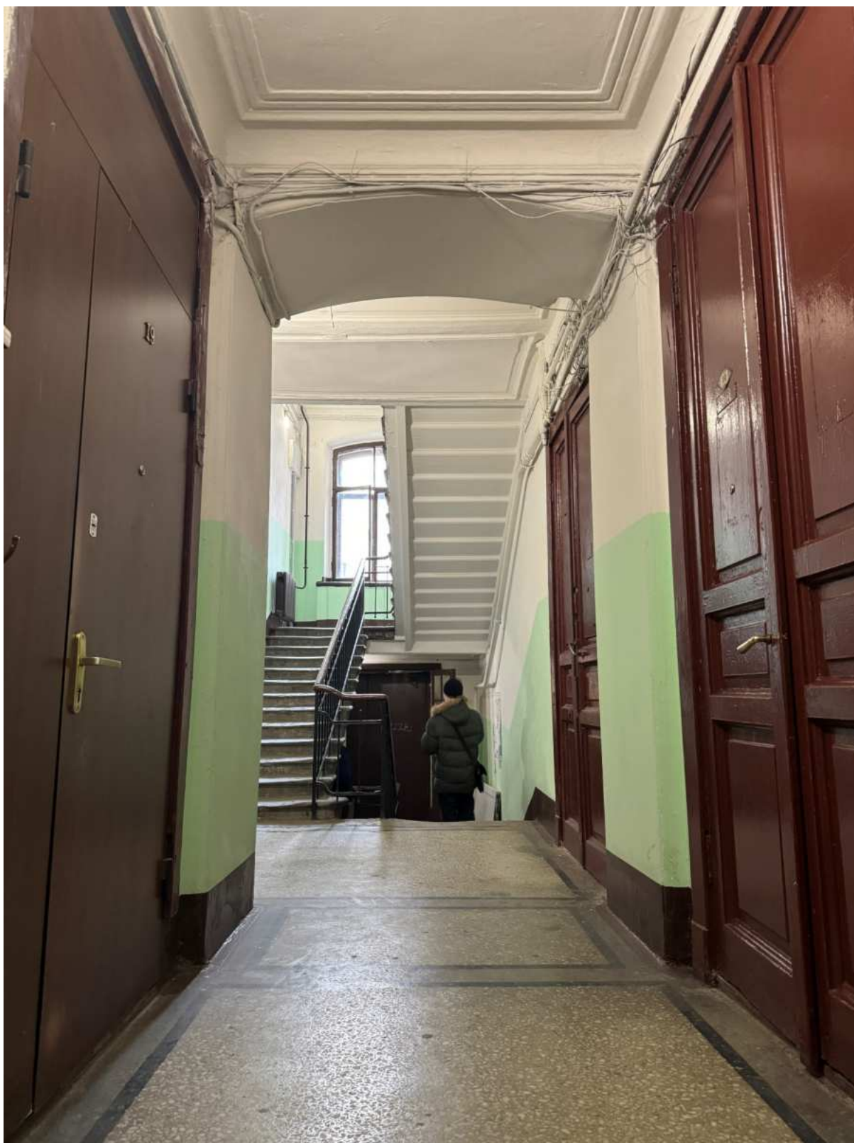
45. Интерьеры в части лестницы 2ЛК объекта культурного наследия.
