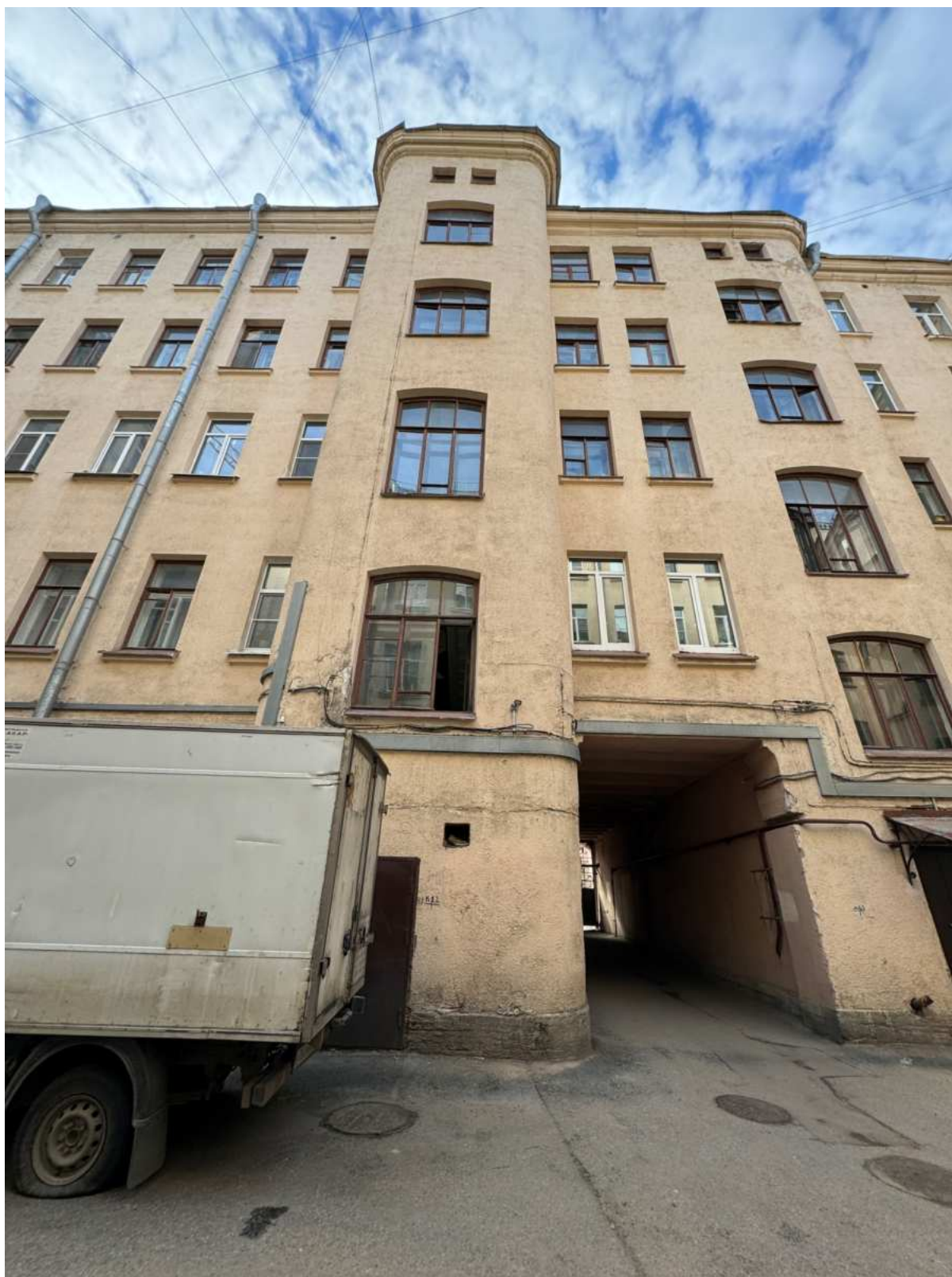
13. Общий вид дворовых фасадов объекта культурного наследия.
