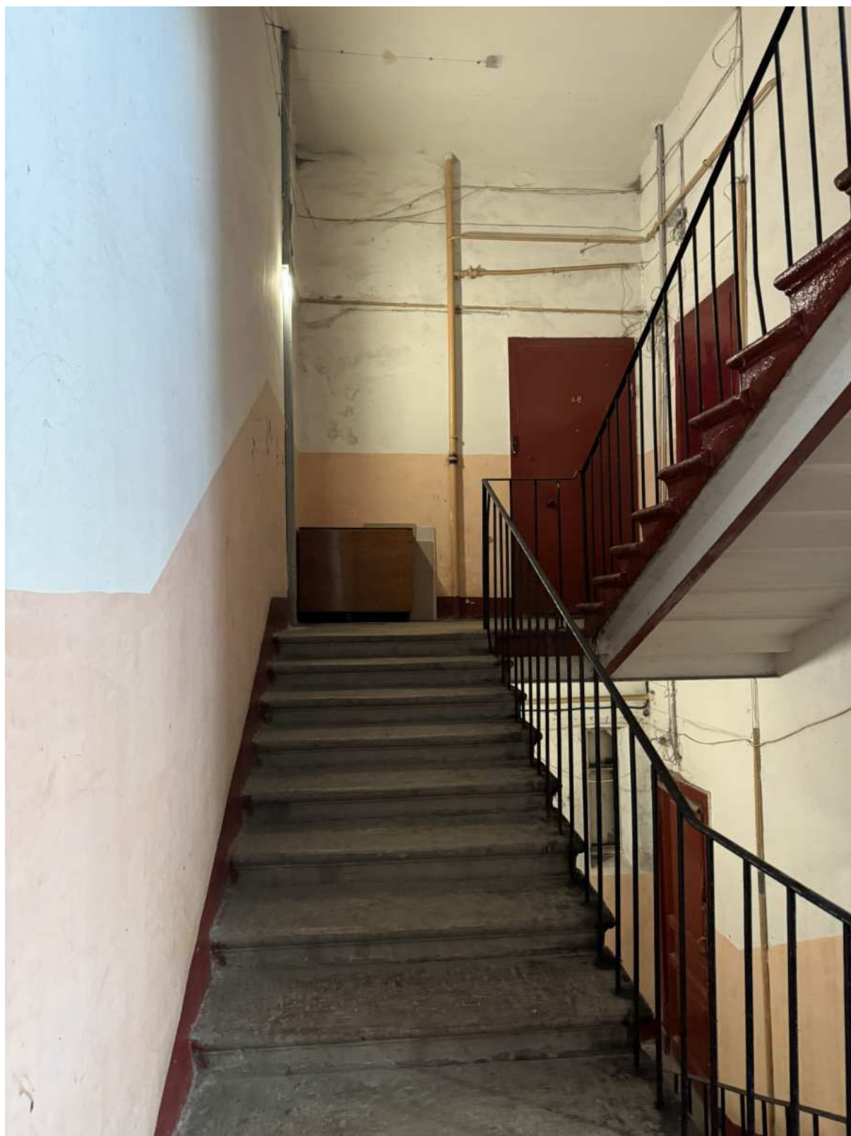
76. Интерьеры в части лестницы 5ЛК объекта культурного наследия.
