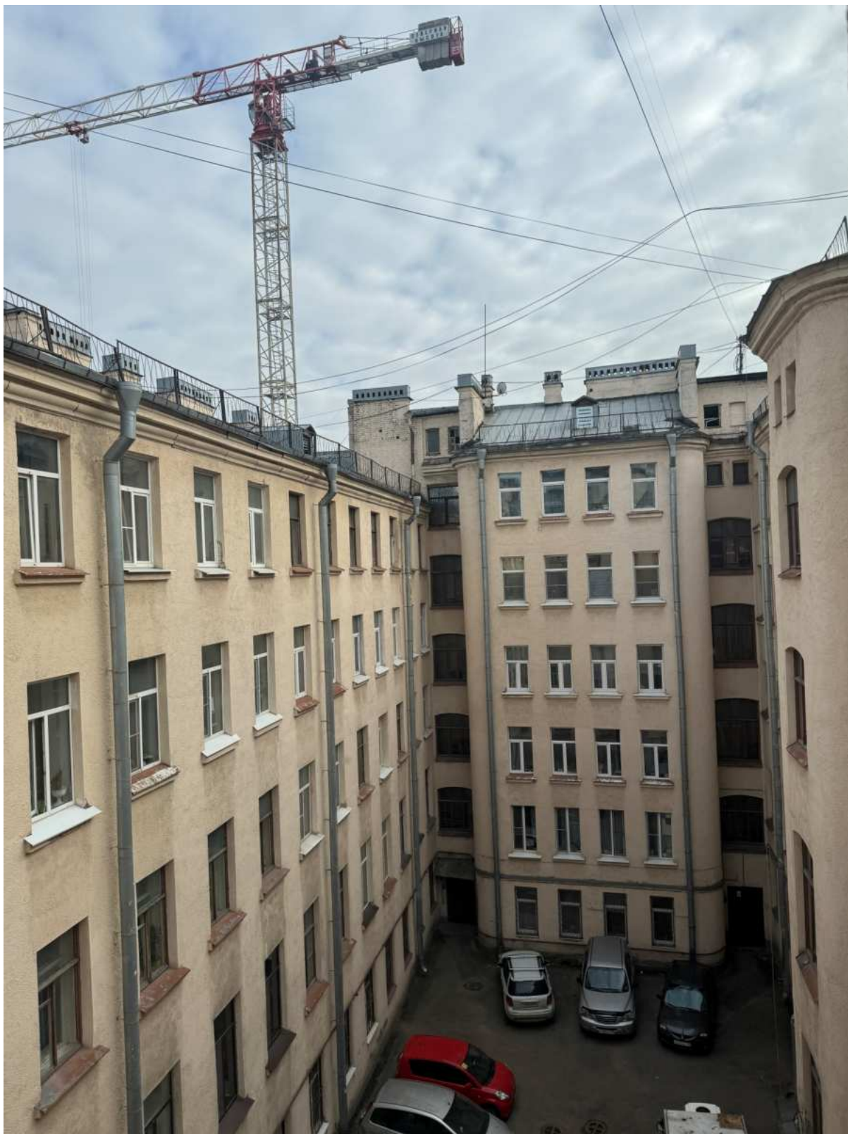
16. Вид на крышу и часть дворовых фасадов объекта культурного наследия.
