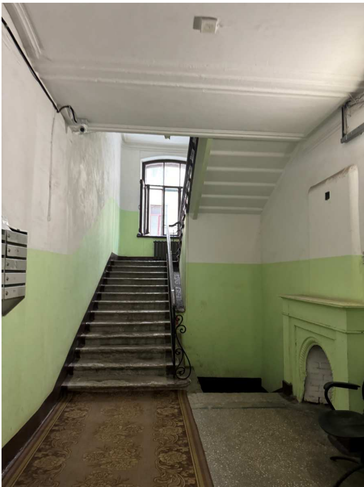
90. Интерьеры в части лестницы БЛК объекта культурного наследия.
