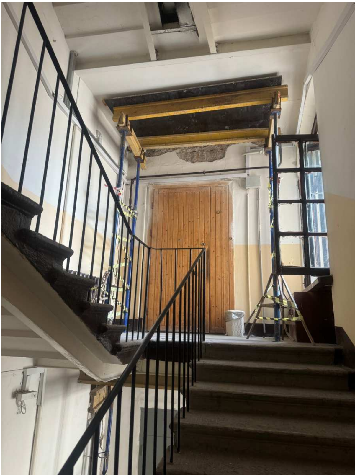
105. Интерьеры в части лестницы 4ЛК объекта культурного наследия.
