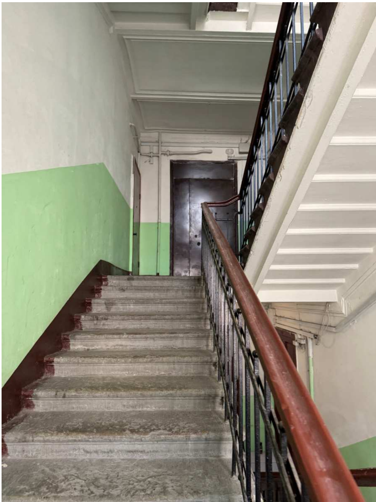
26. Интерьеры в части лестницы 1ЛК объекта культурного наследия.
