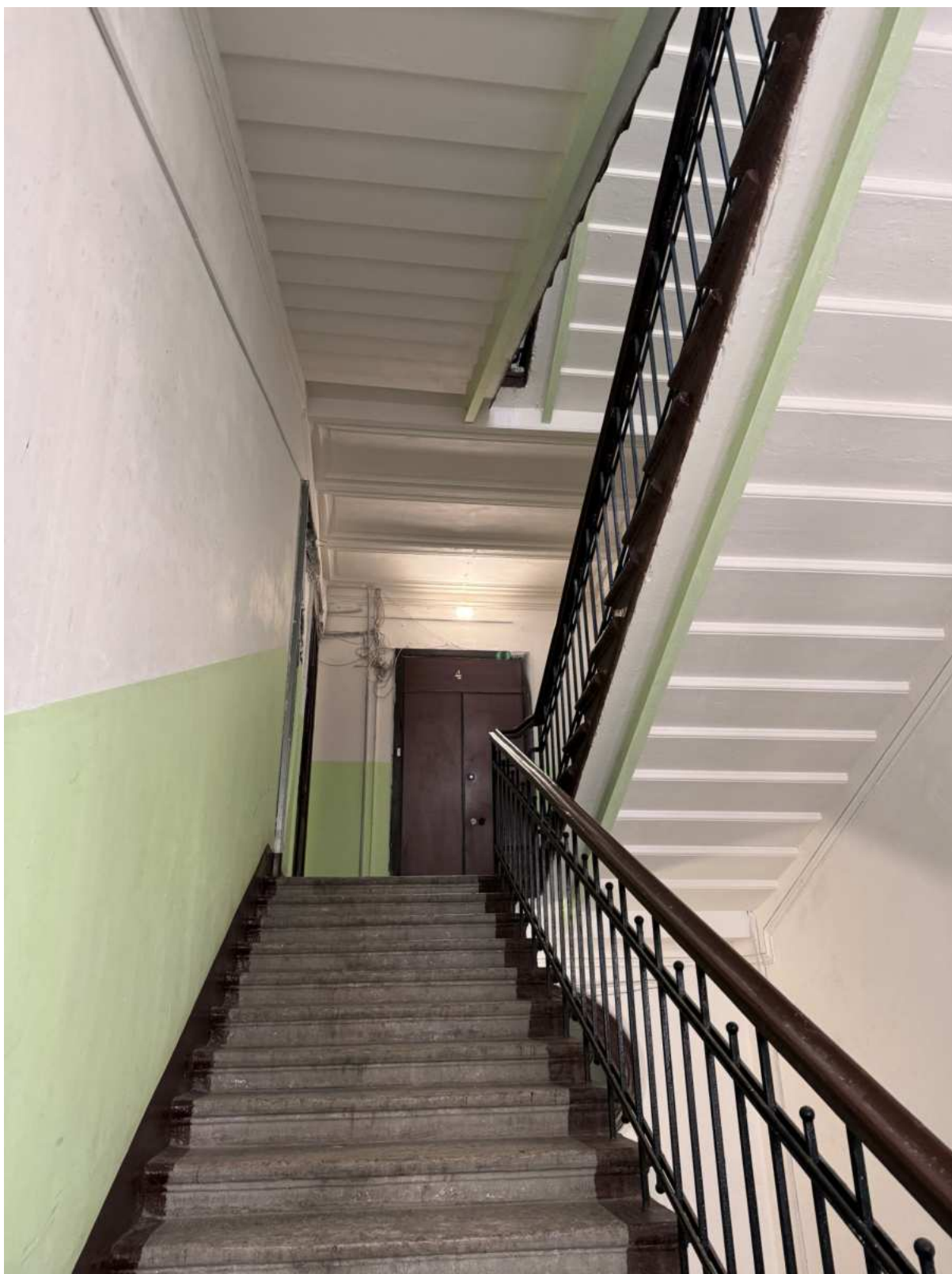
95. Интерьеры в части лестницы БЛК объекта культурного наследия.
