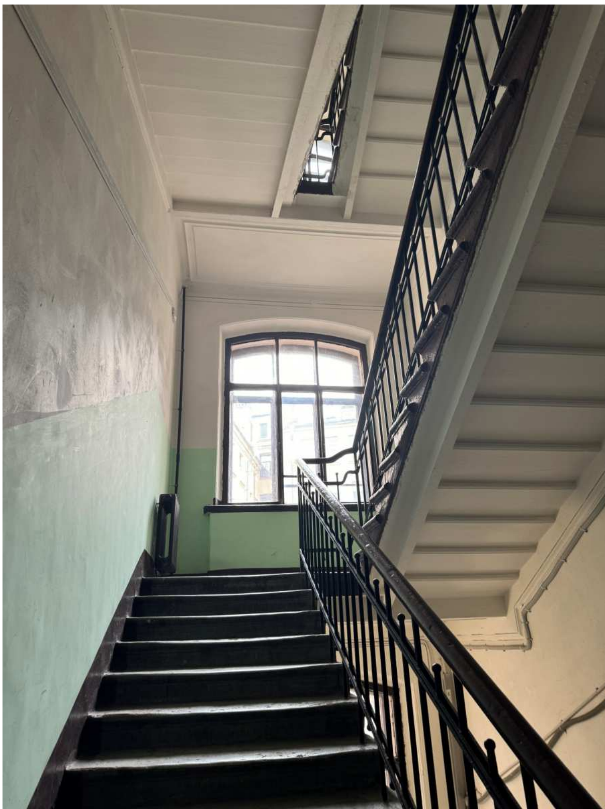
49. Интерьеры в части лестницы 2ЛК объекта культурного наследия.
