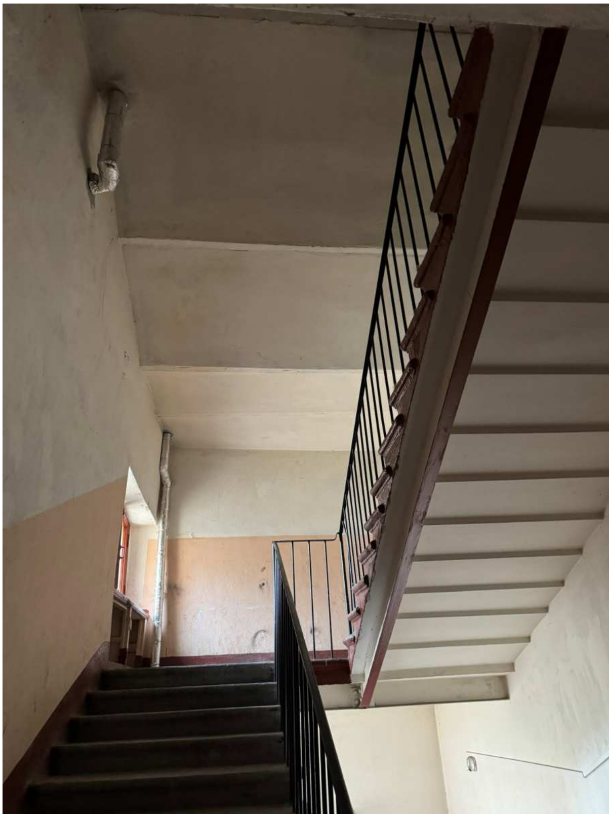
81. Интерьеры в части лестницы 5ЛК объекта культурного наследия.
