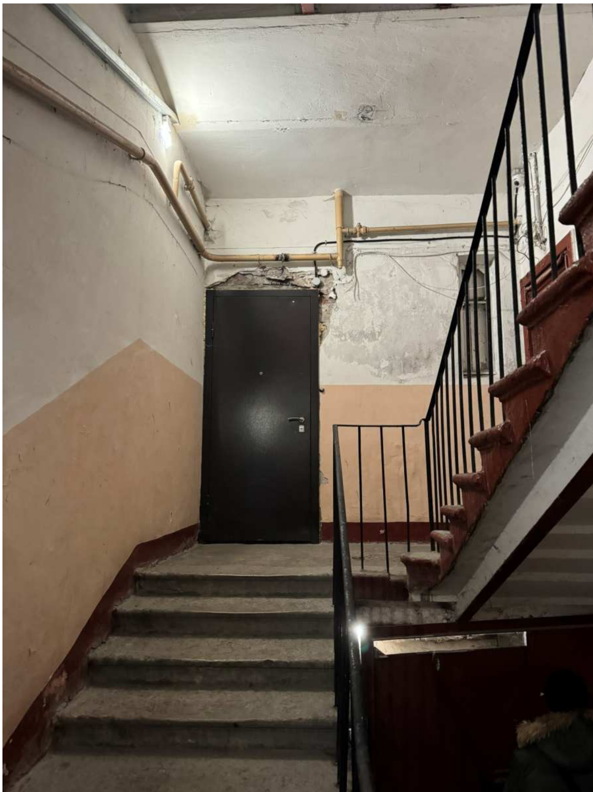
74. Интерьеры в части лестницы 5ЛК объекта культурного наследия.
