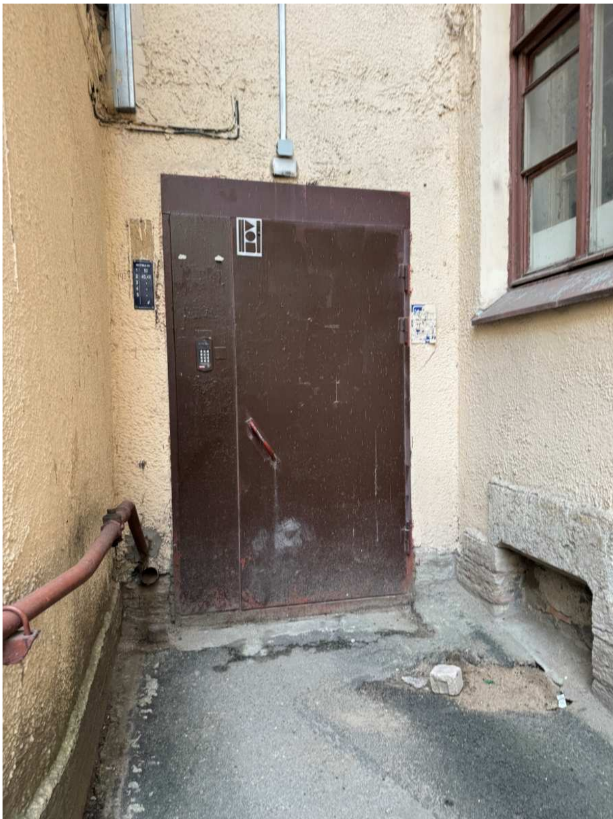
71. Вход с дворового фасада в помещения лестницы 5ЛК объекта культурного наследия.
