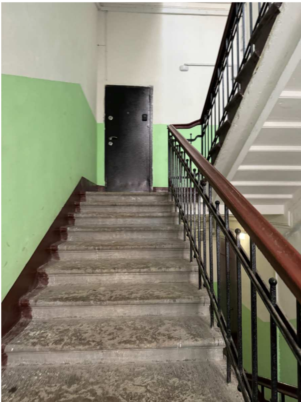
23. Интерьеры в части лестницы 1ЛК объекта культурного наследия.
