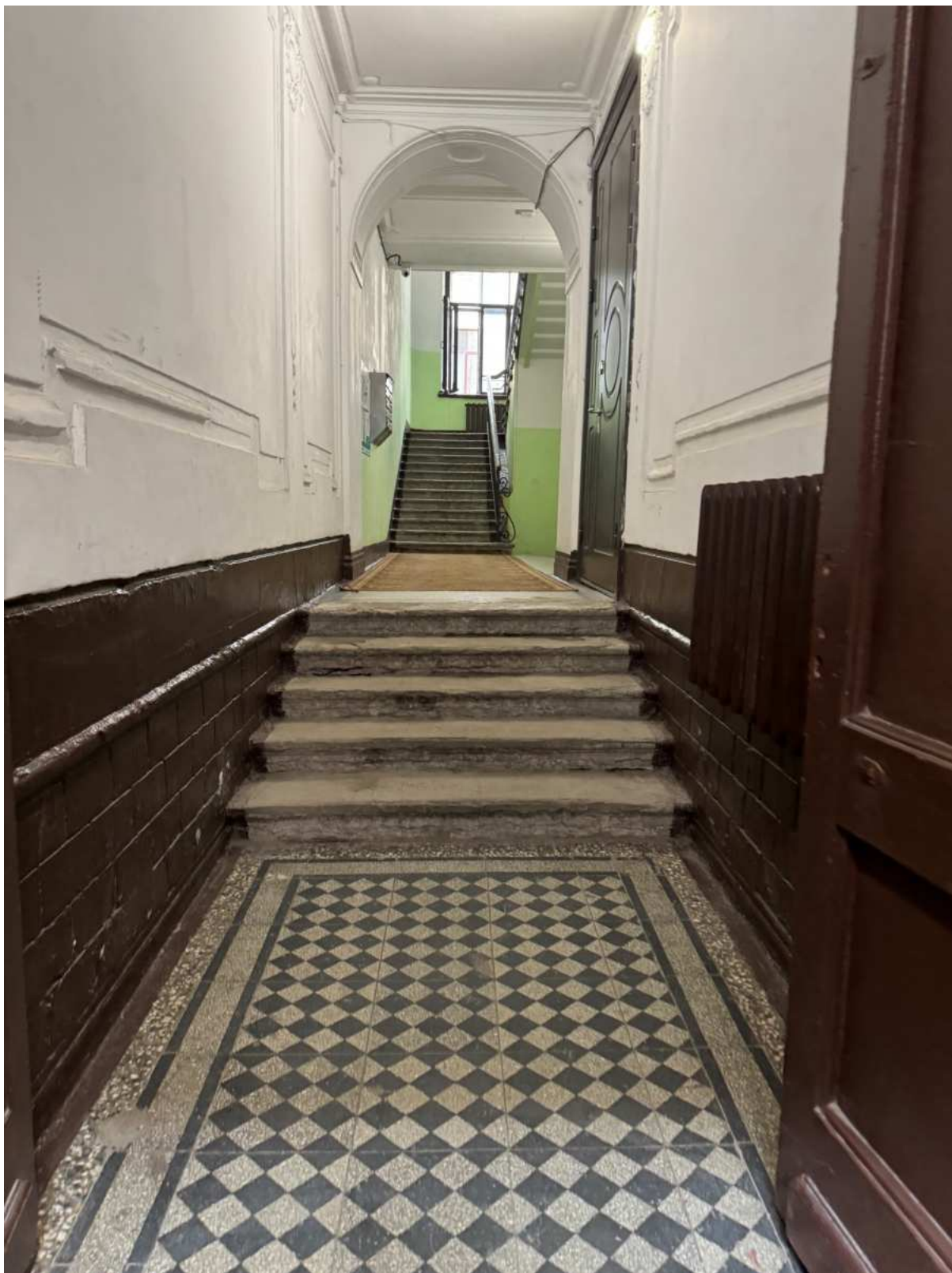
87. Интерьеры в части лестницы БЛК объекта культурного наследия.
