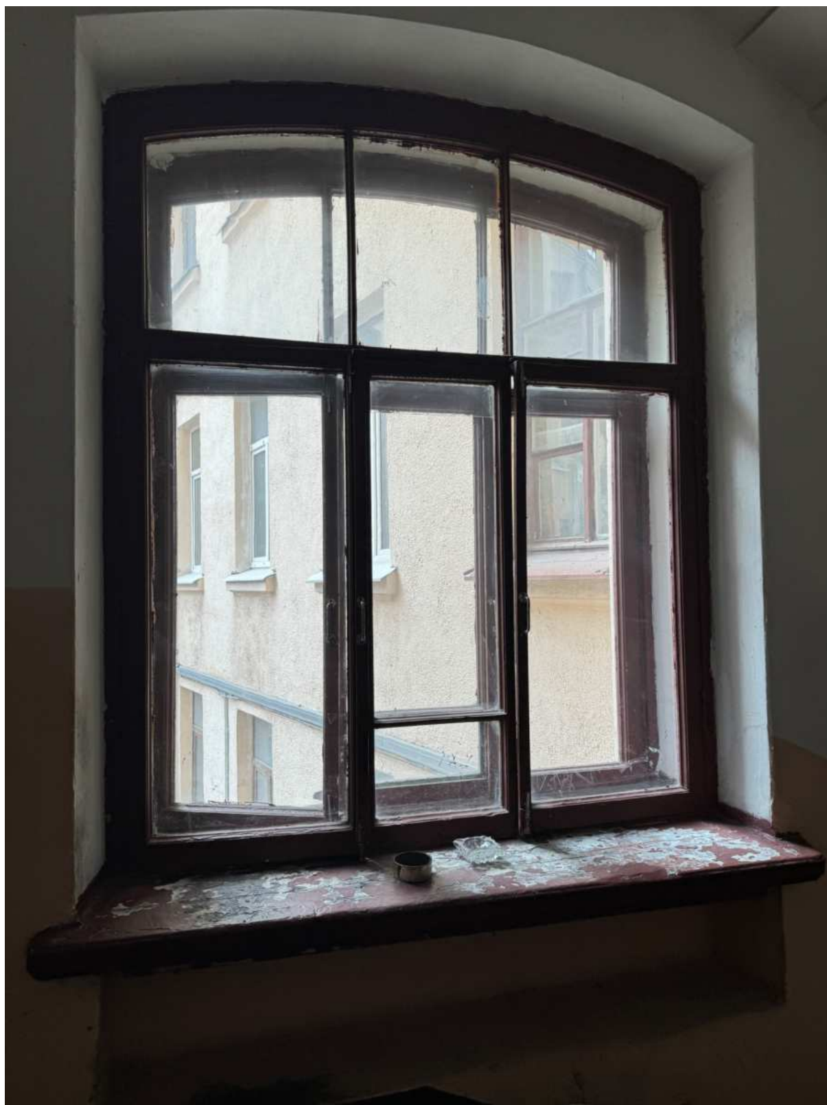
57. Оконное заполнение в части лестницы ЗЛК объекта культурного наследия.
