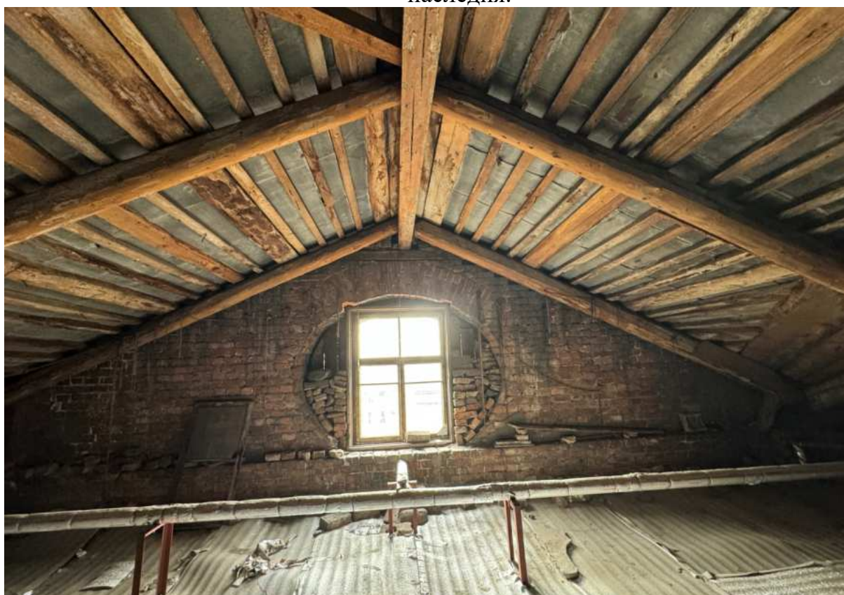
35. Чердачные помещения в части лестницы 1ЛК объекта культурного наследия.
