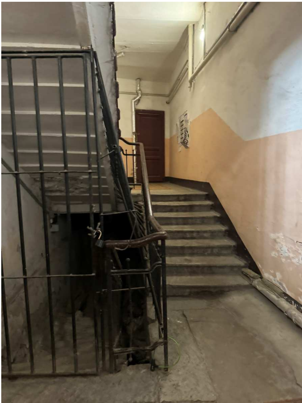
53. Интерьеры в части лестницы ЗЛК объекта культурного наследия.
