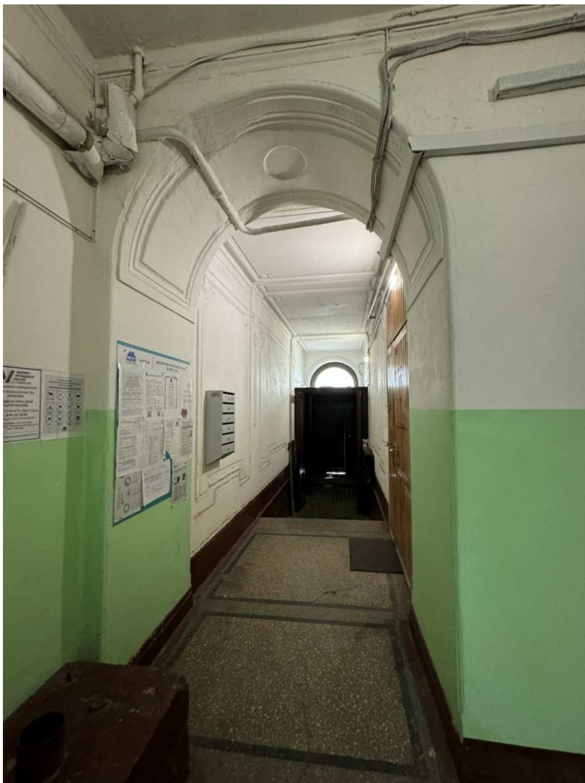
19. Интерьеры в части лестницы 1ЛК объекта культурного наследия.
