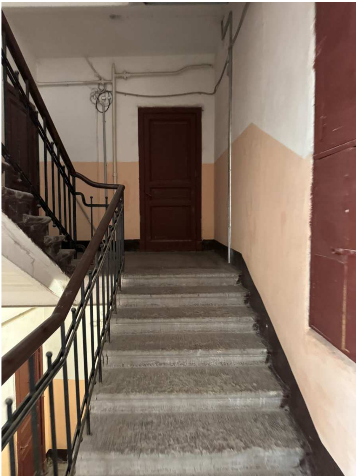
59. Интерьеры в части лестницы ЗЛК объекта культурного наследия.
