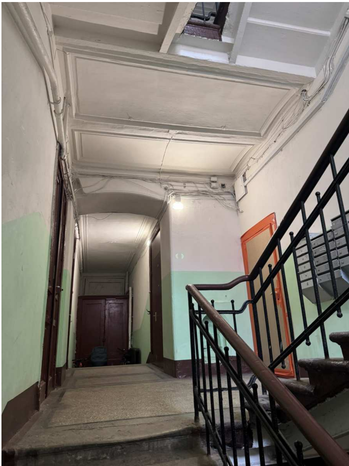
43. Интерьеры в части лестницы 2ЛК объекта культурного наследия.
