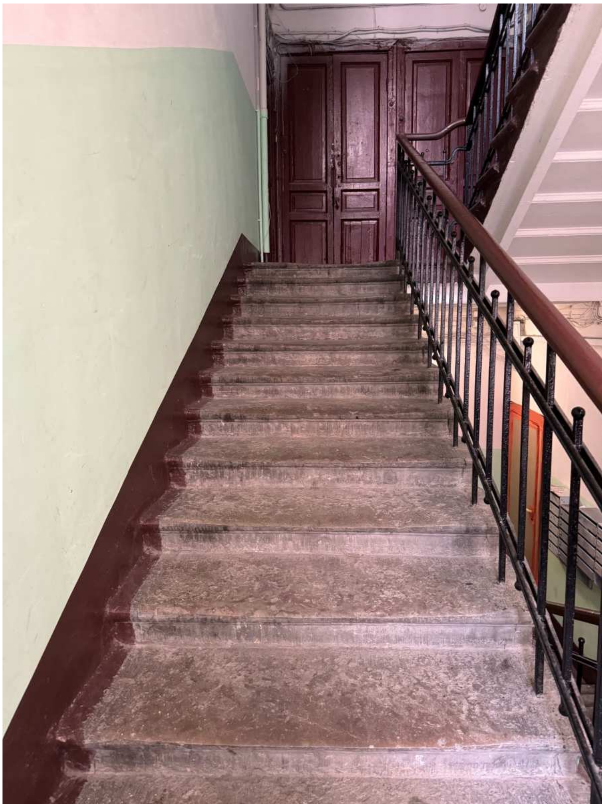
48. Интерьеры в части лестницы 2ЛК объекта культурного наследия.
