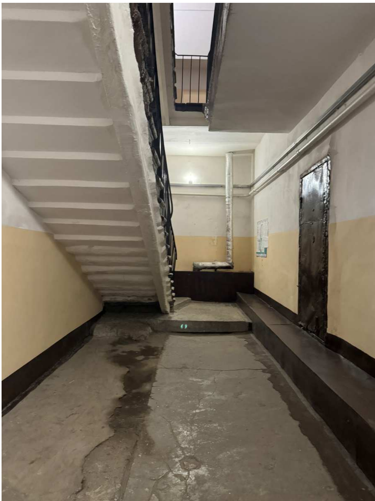
63. Интерьеры в части лестницы 4ЛК объекта культурного наследия.
