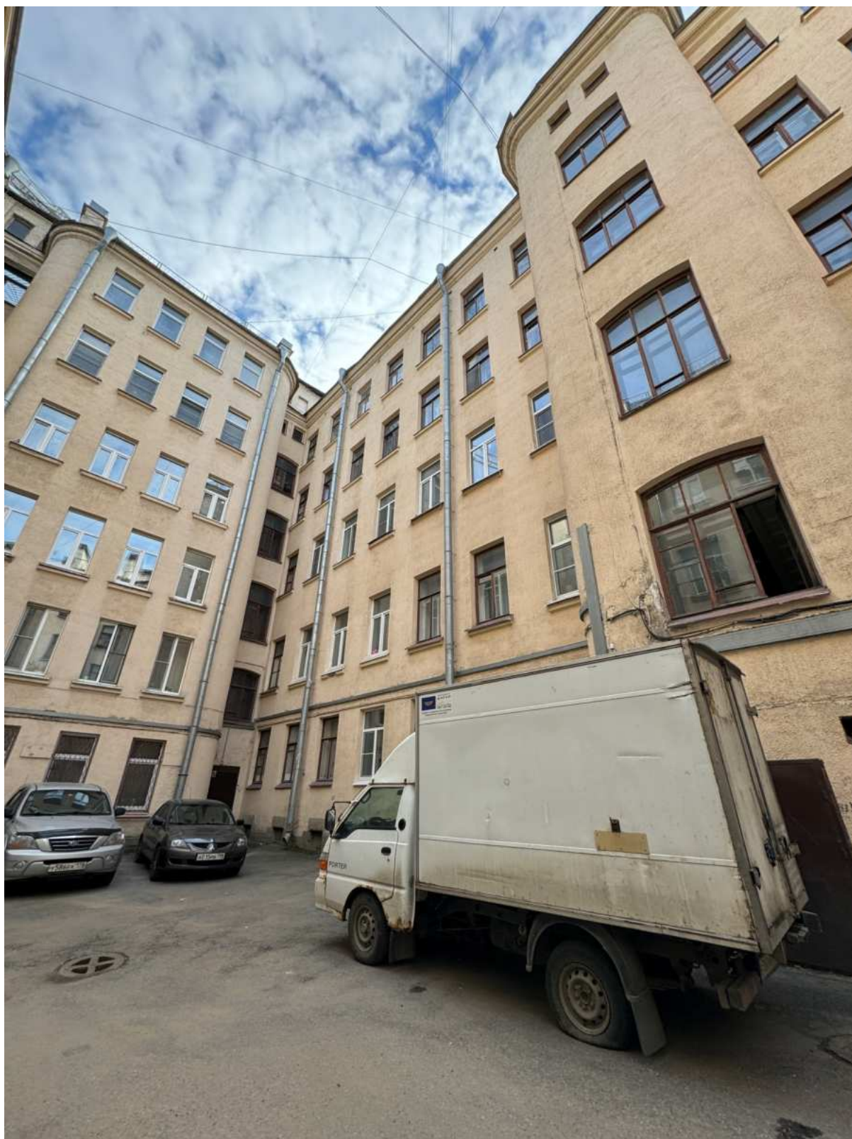
12. Общий вид дворовых фасадов объекта культурного наследия.
