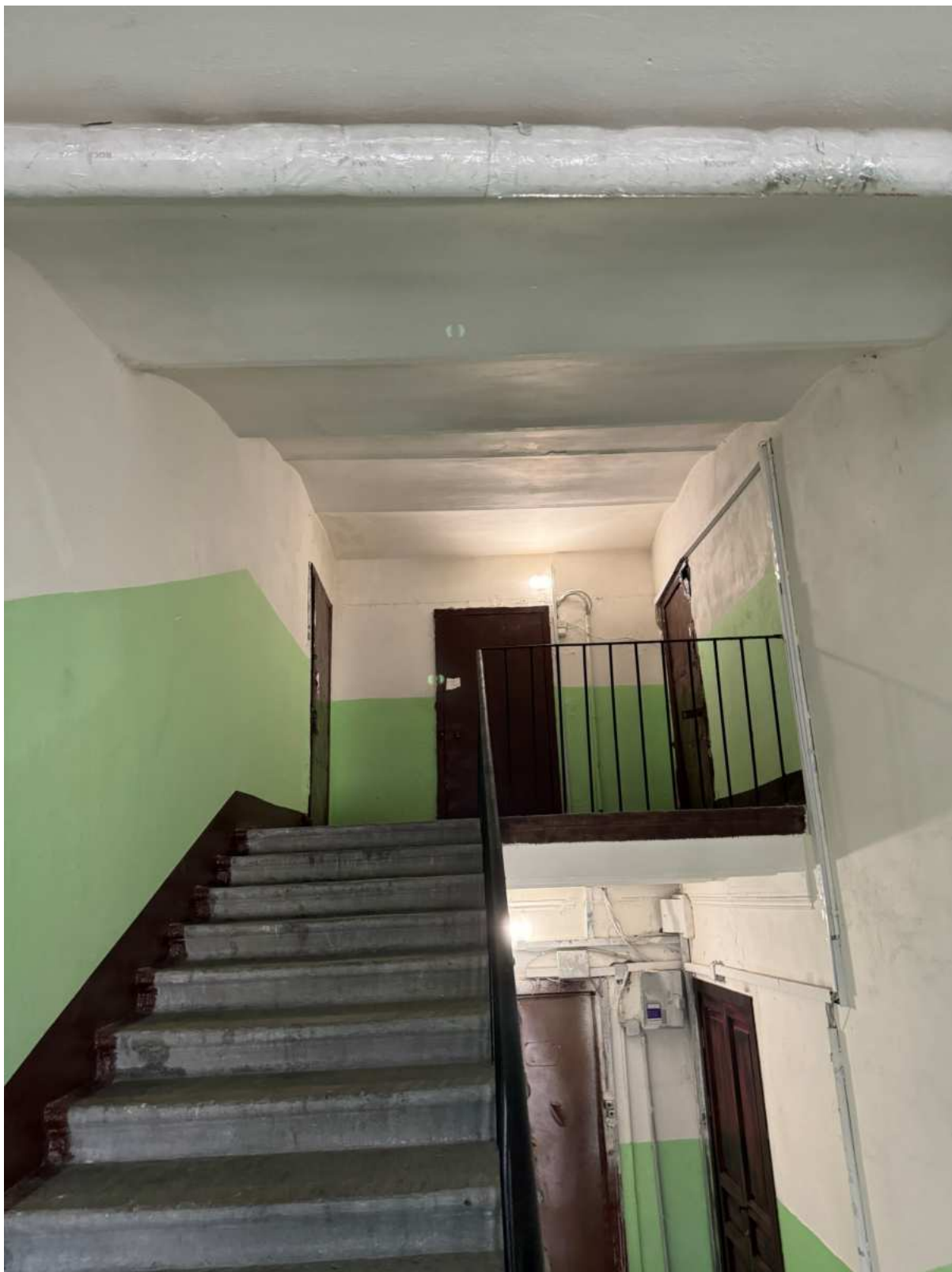
28. Интерьеры в части лестницы 1ЛК объекта культурного наследия.
