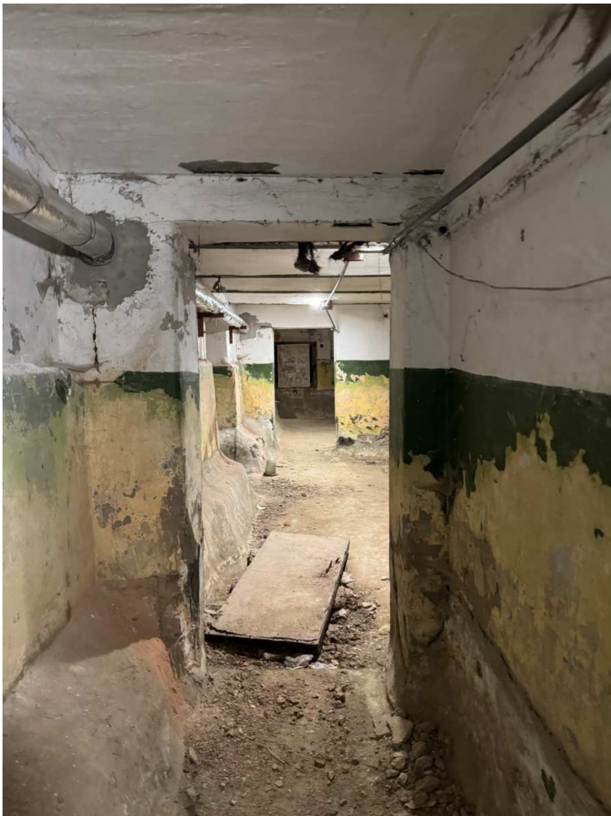
85. Подвальные помещения в части лестницы 5ЛК объекта культурного наследия.
