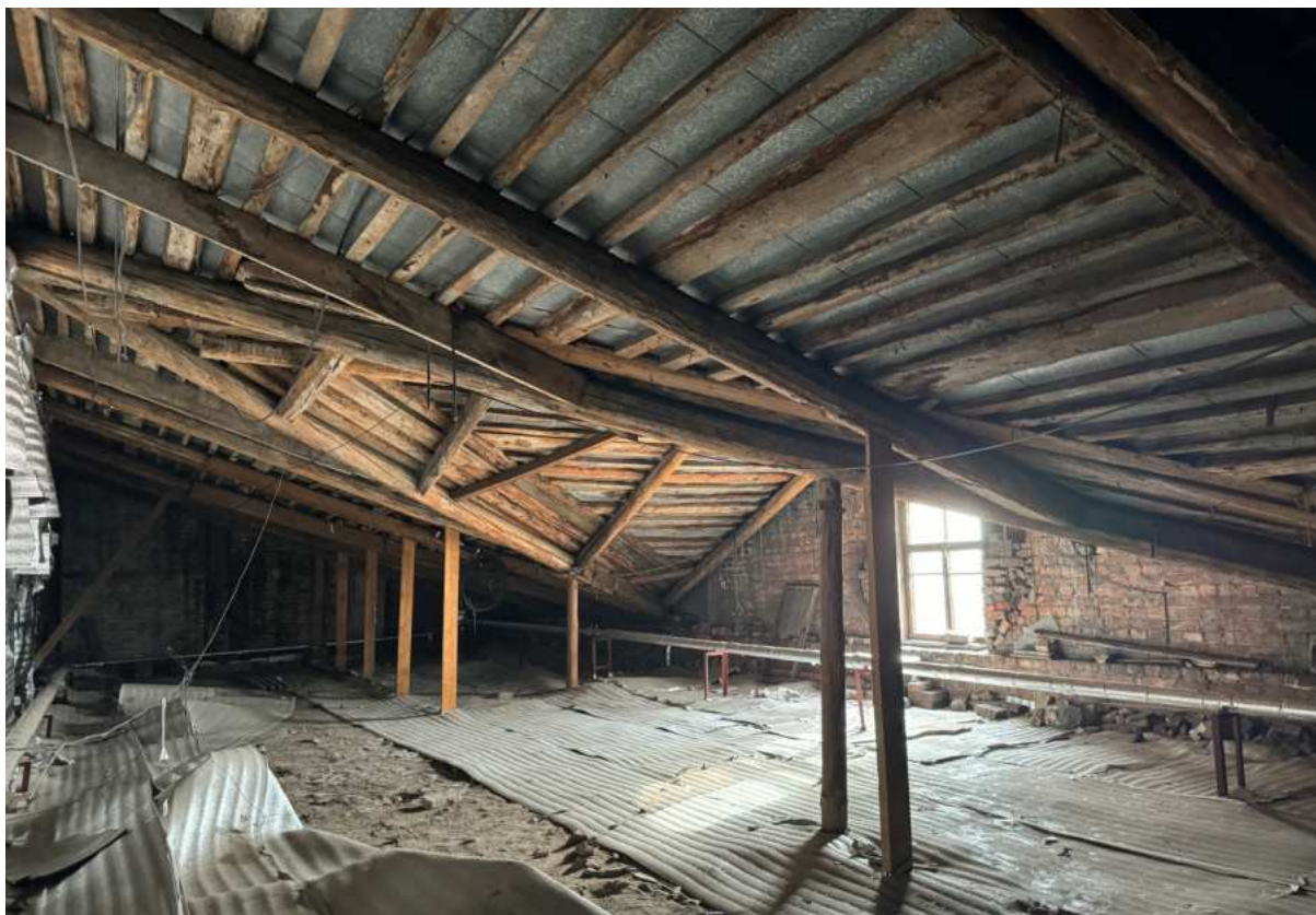
34. Чердачные помещения в части лестницы 1ЛК объекта культурного наследия.
