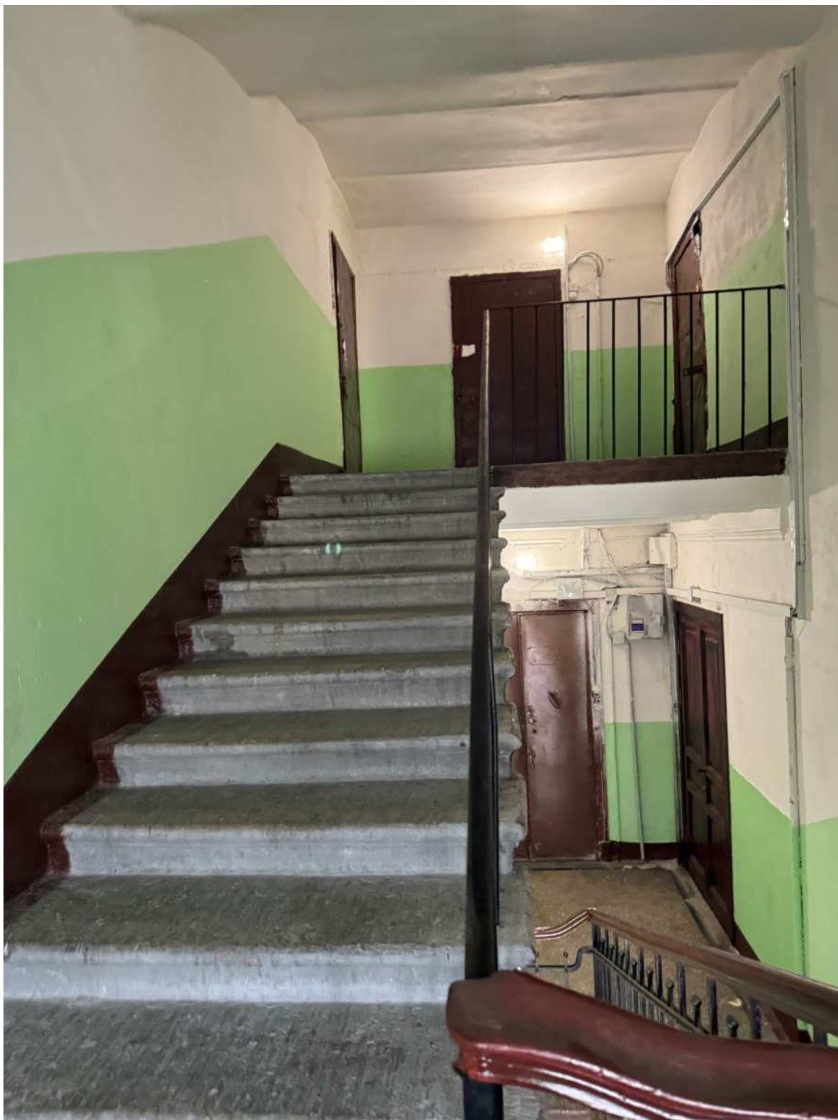
27. Интерьеры в части лестницы 1ЛК объекта культурного наследия.
