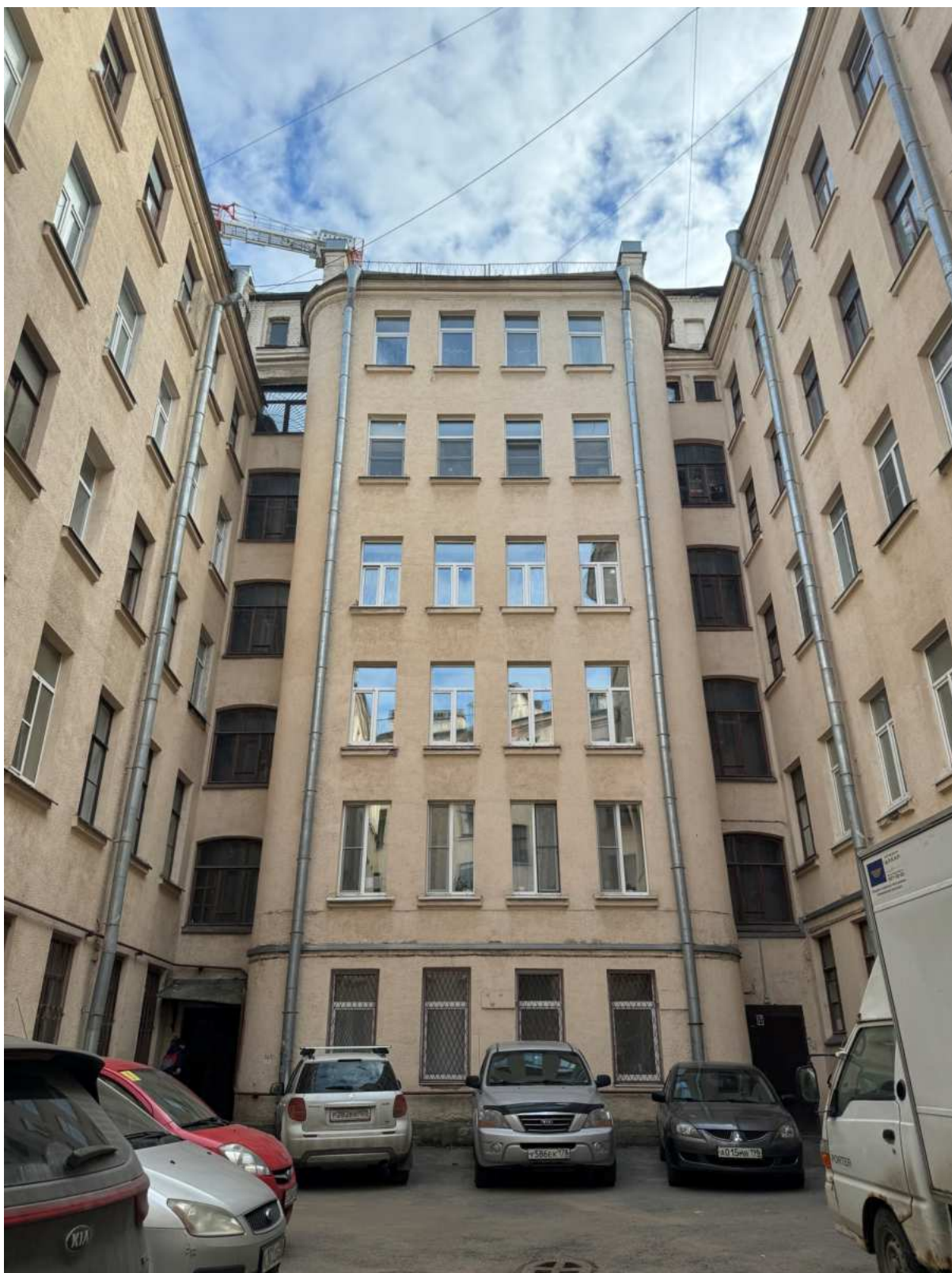
8. Общий вид дворовых фасадов объекта культурного наследия.
