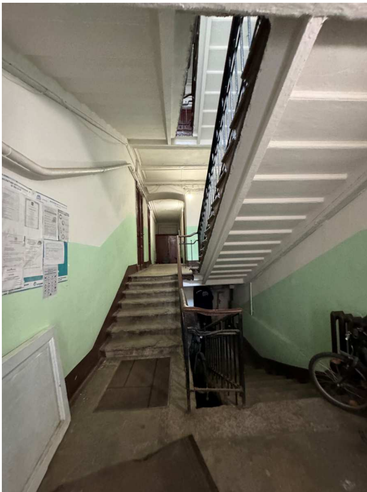
37. Интерьеры в части лестницы 2ЛК объекта культурного наследия.
