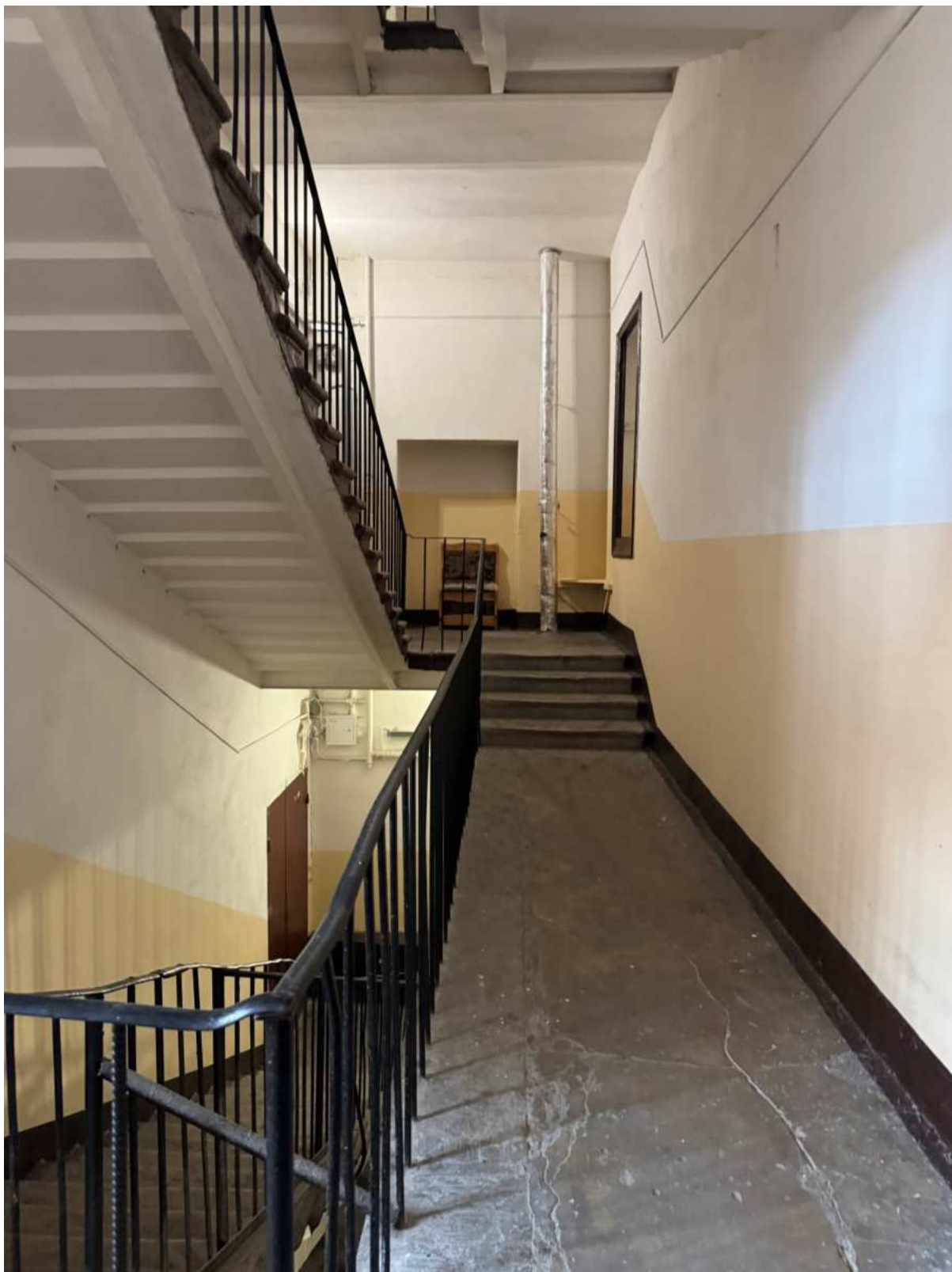
65. Интерьеры в части лестницы 4ЛК объекта культурного наследия.
