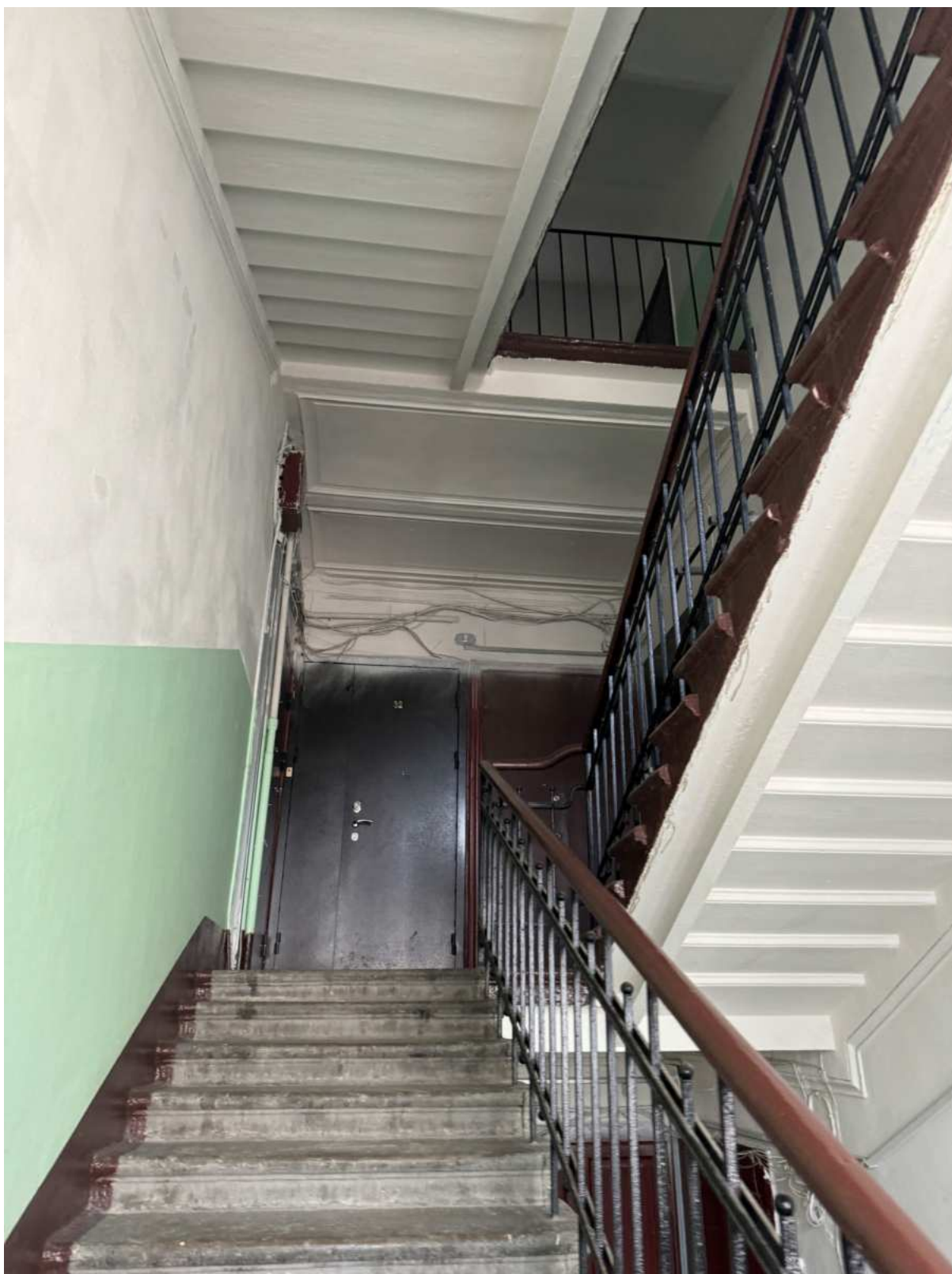
50. Интерьеры в части лестницы 2ЛК объекта культурного наследия.
