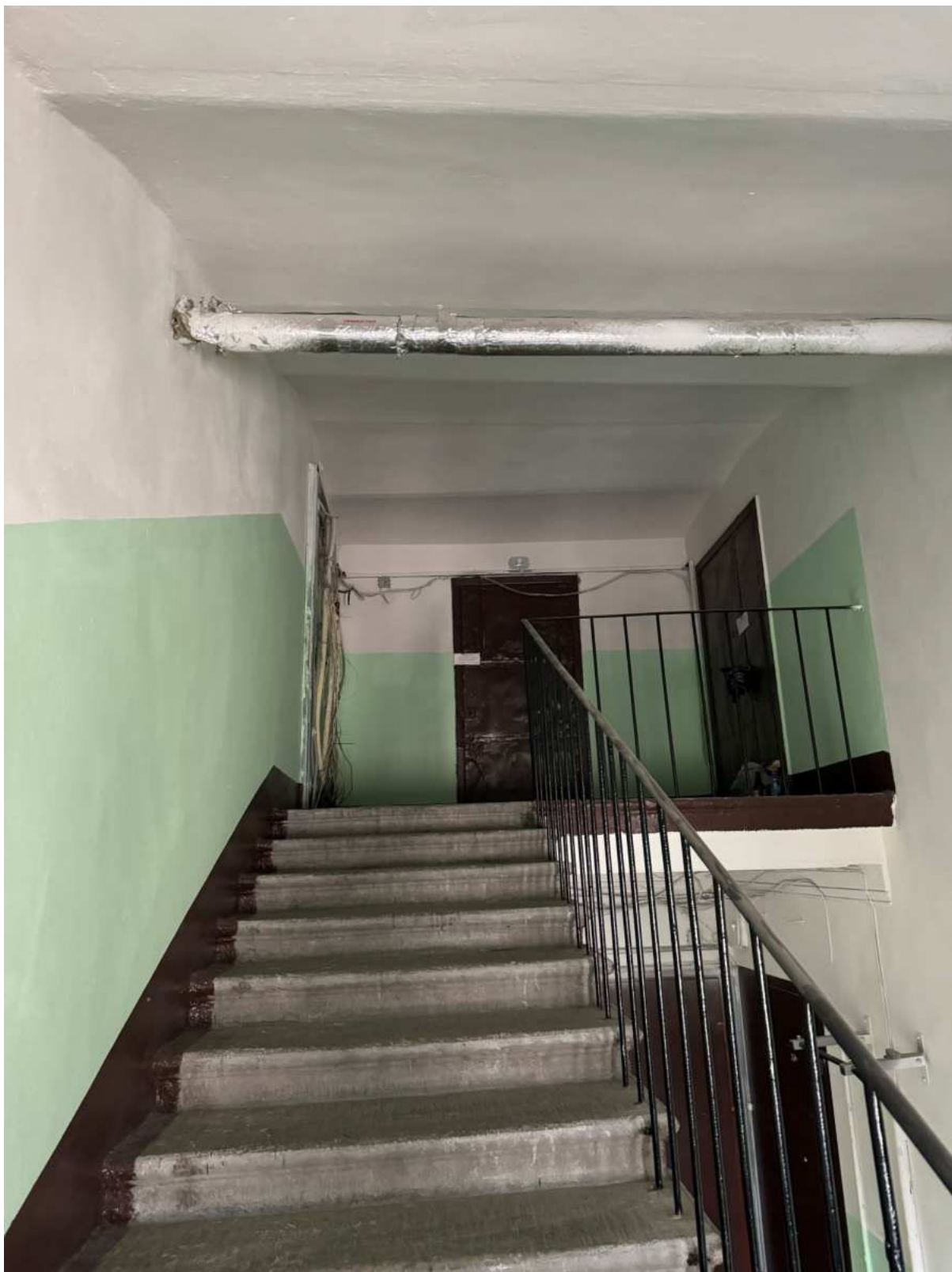
51. Интерьеры в части лестницы 2ЛК объекта культурного наследия.
