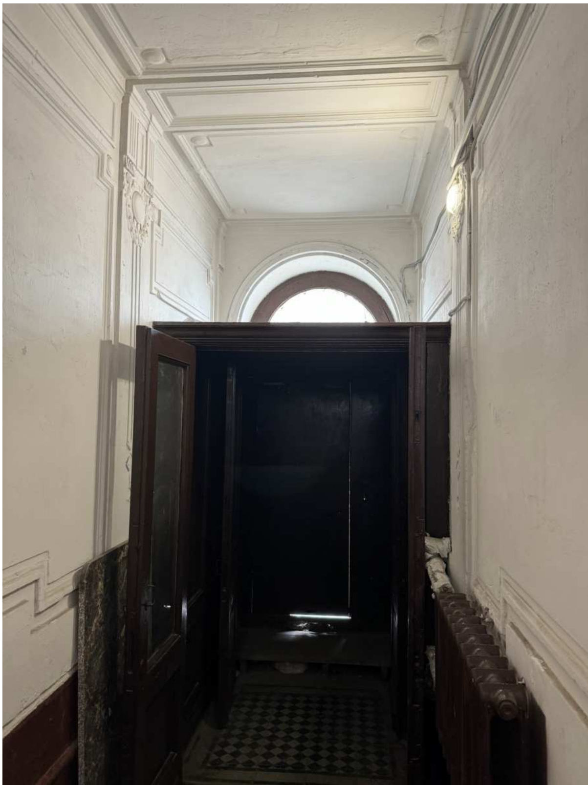
20. Интерьеры в части лестницы 1ЛК объекта культурного наследия.
