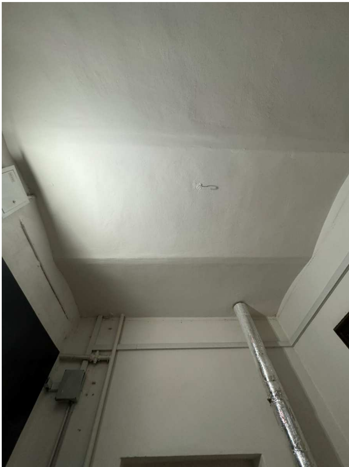
67. Интерьеры в части лестницы 4ЛК объекта культурного наследия.
