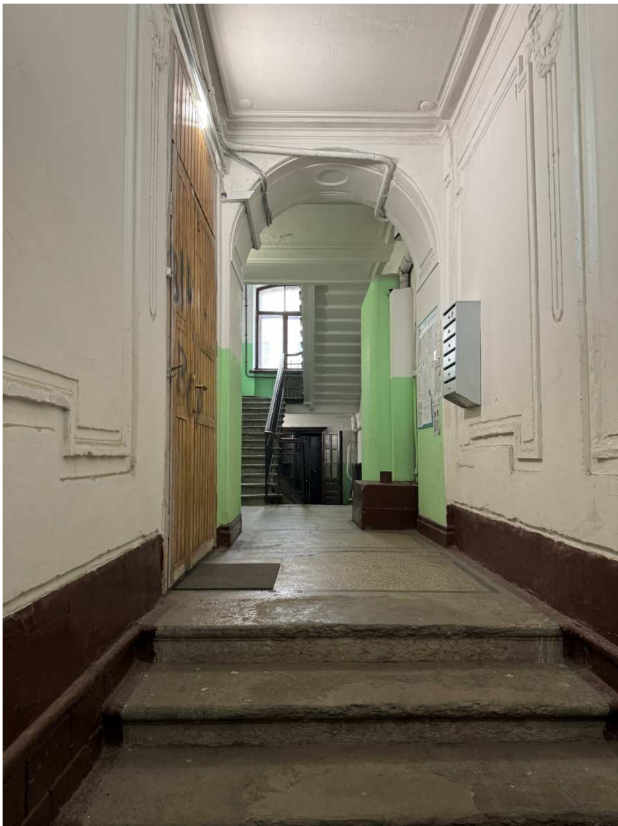
21. Интерьеры в части лестницы 1ЛК объекта культурного наследия.
