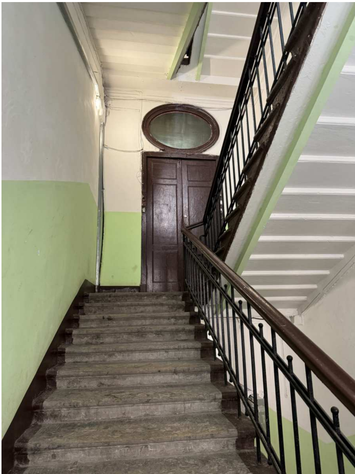
93. Интерьеры в части лестницы 6ЛК объекта культурного наследия.
