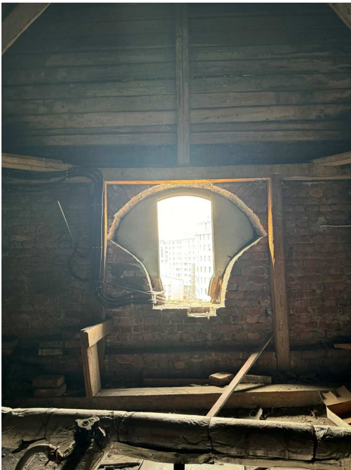
33. Чердачные помещения в части башни объекта культурного наследия.
