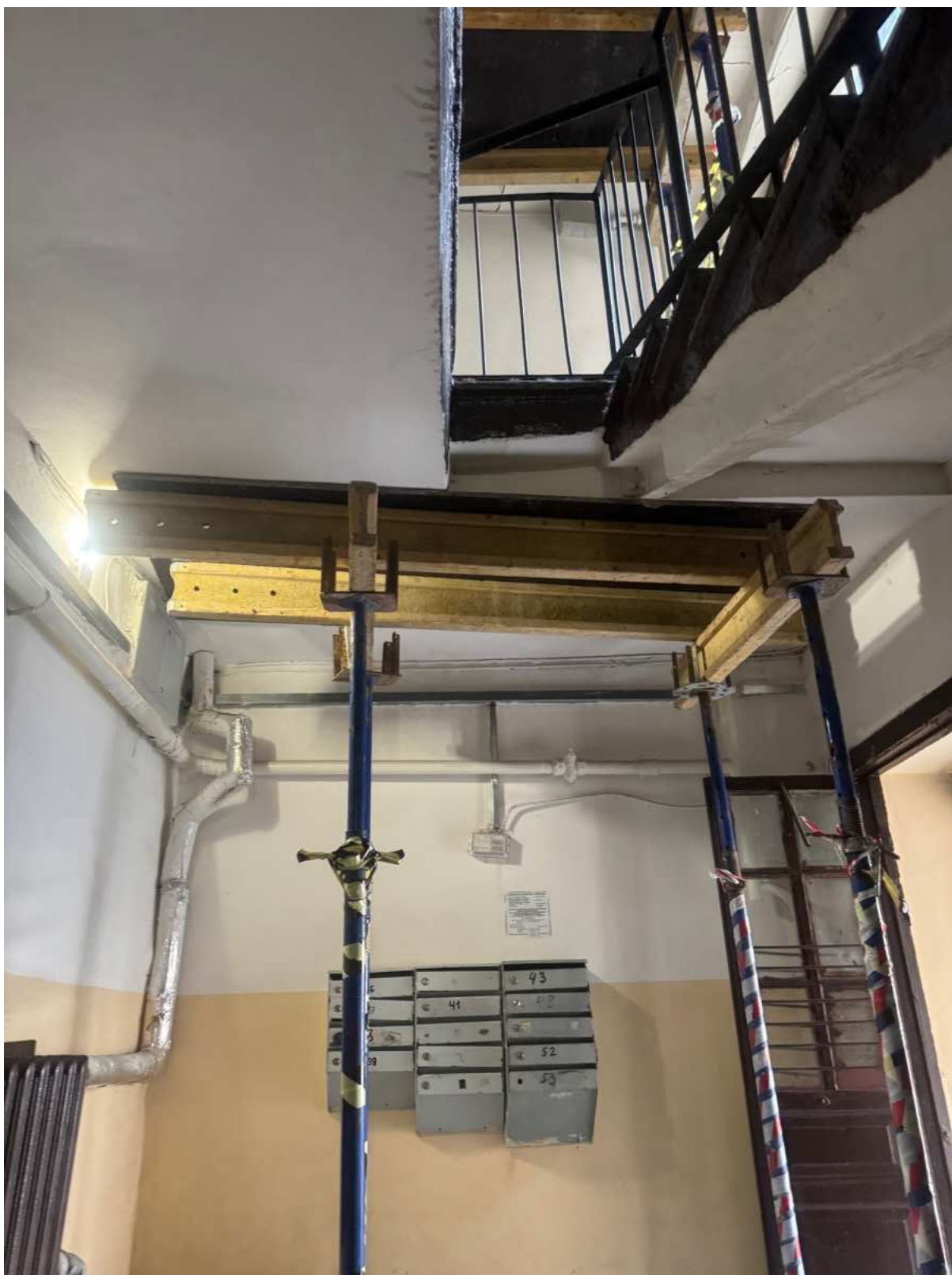
103. Подпорные элементы конструкций в части лестницы 4ЛК объекта культурного наследия.
