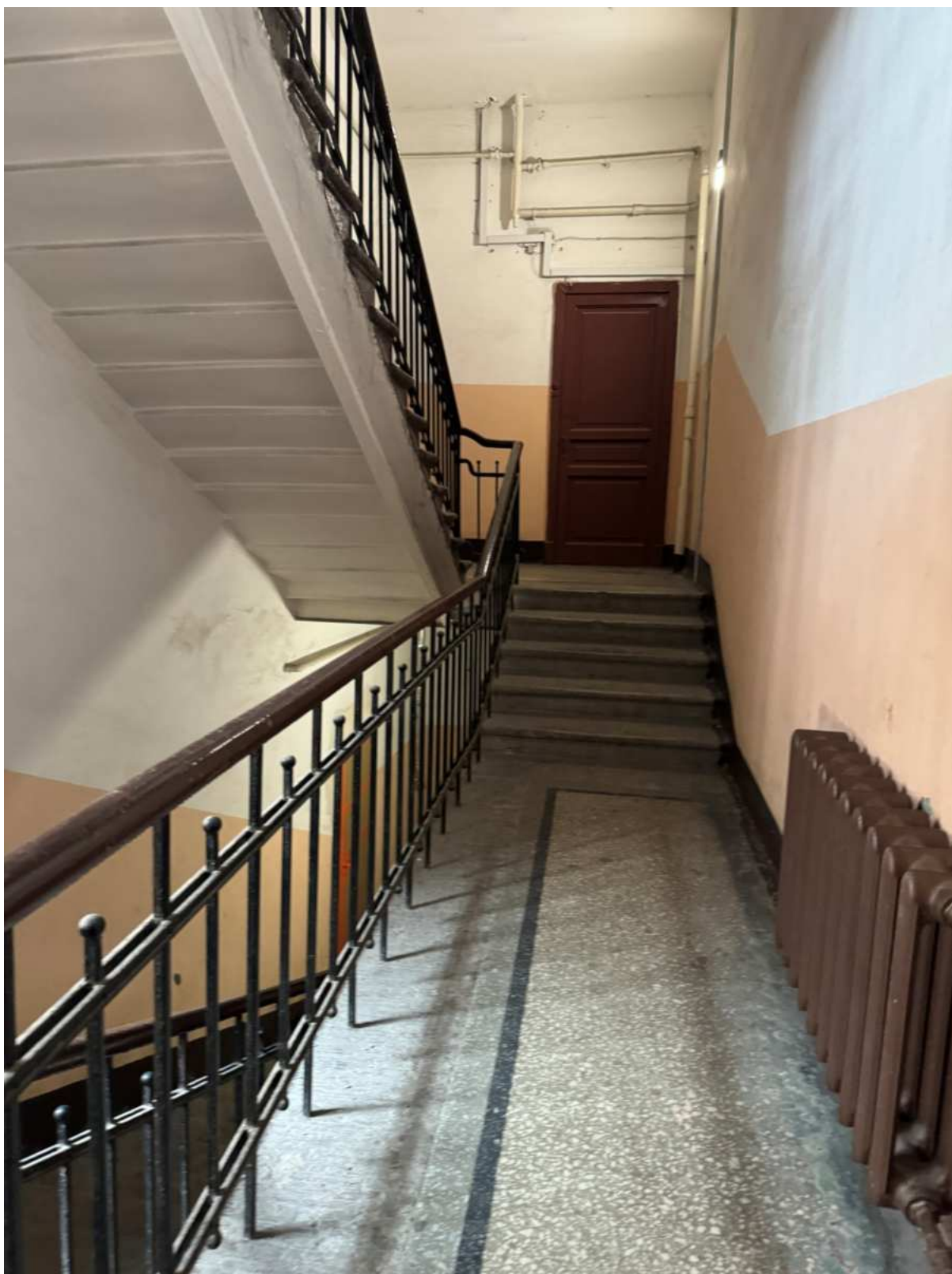
55. Интерьеры в части лестницы ЗЛК объекта культурного наследия.
