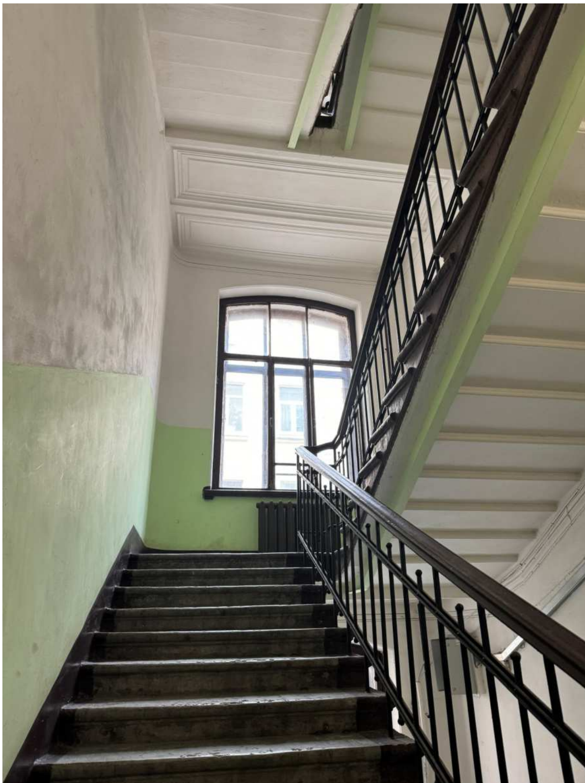
94. Интерьеры в части лестницы 6ЛК объекта культурного наследия.
