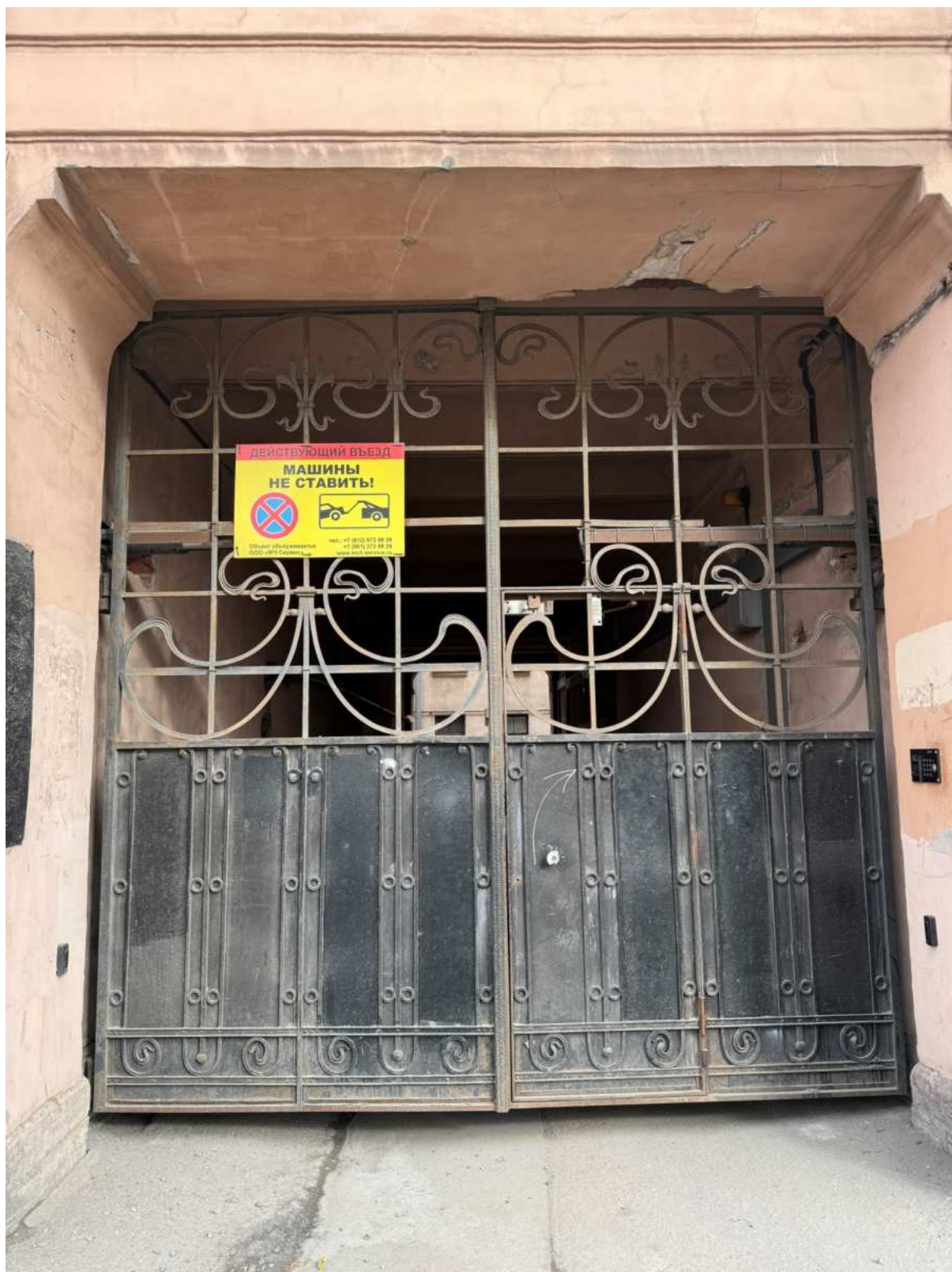
7. Заполнение воротного проезда объекта культурного наследия по 8-й линии В.О.
