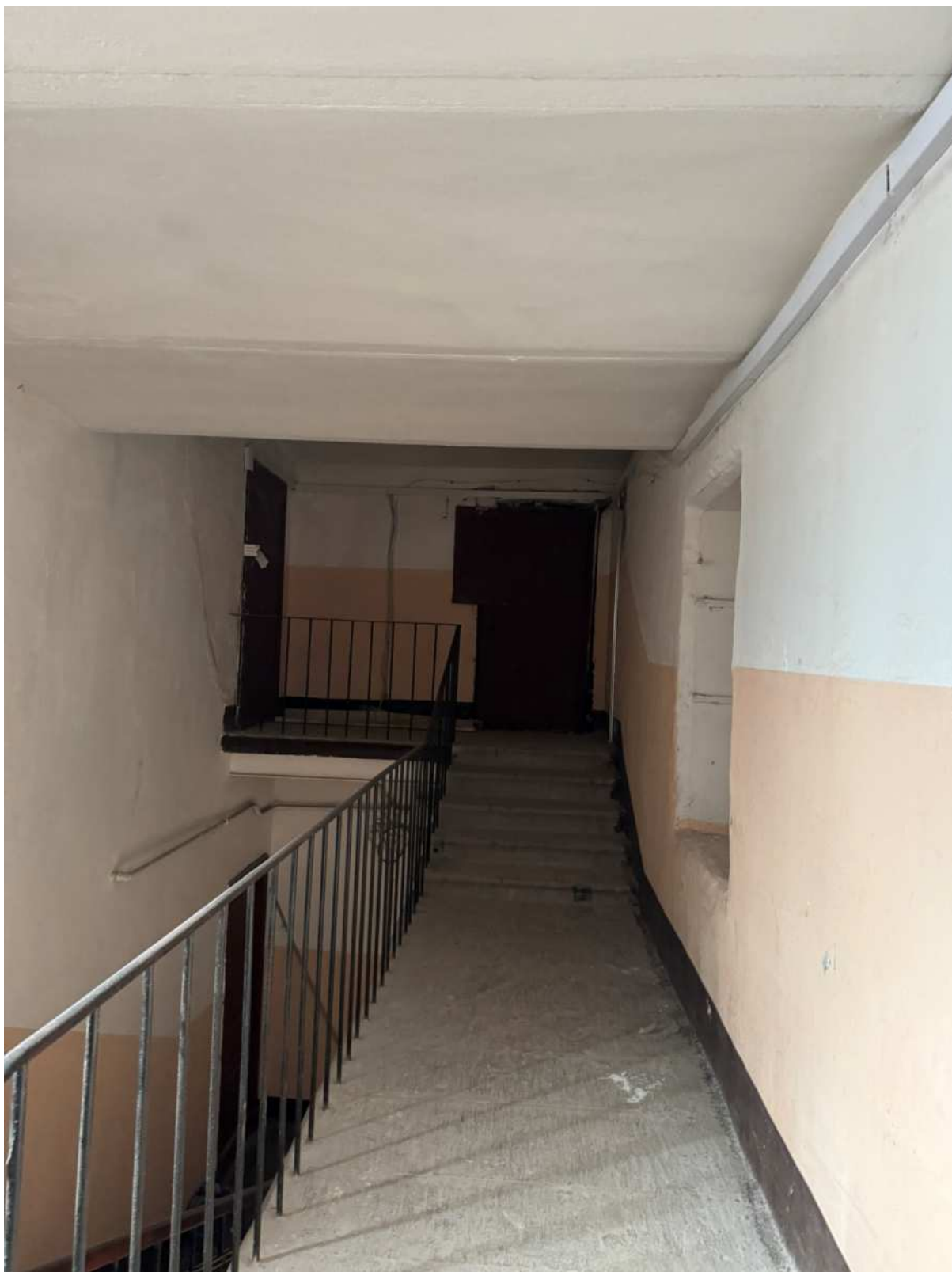
61. Интерьеры в части лестницы ЗЛК объекта культурного наследия.
