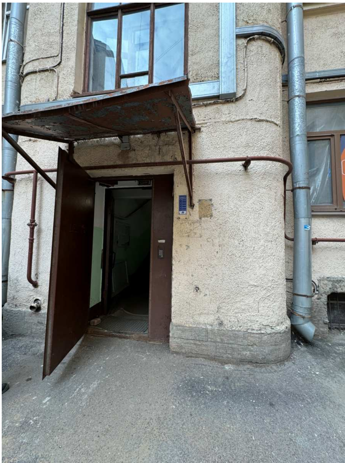
36. Вход с дворового фасада в части лестницы 2ЛК объекта культурного наследия.
