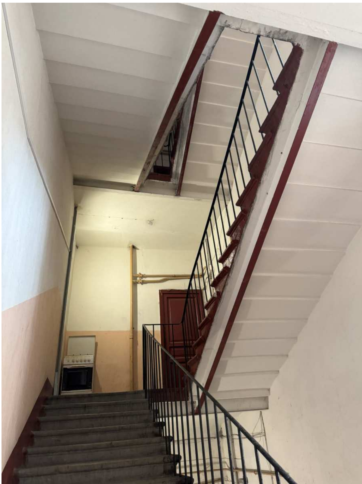
78. Интерьеры в части лестницы 5ЛК объекта культурного наследия.
