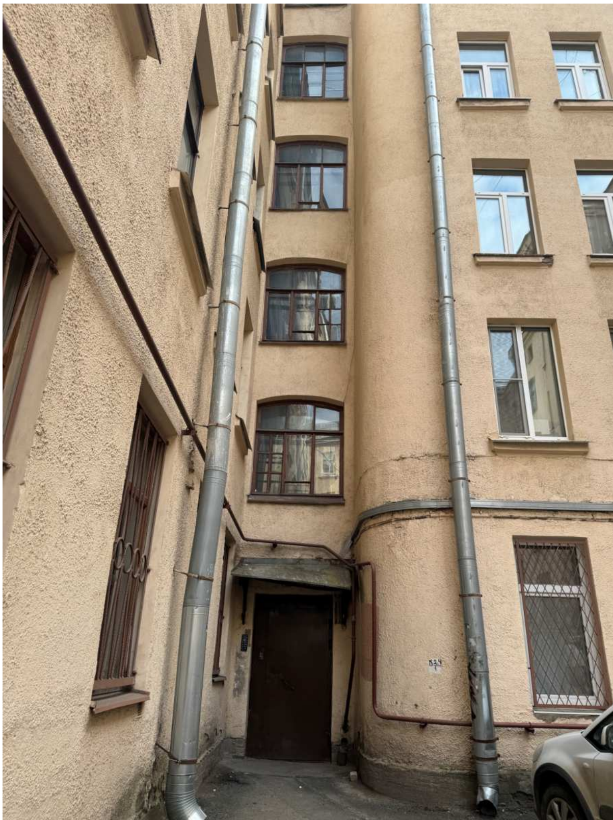
62. Вход с дворового фасада в помещения лестницы 4ЛК объекта культурного наследия.
