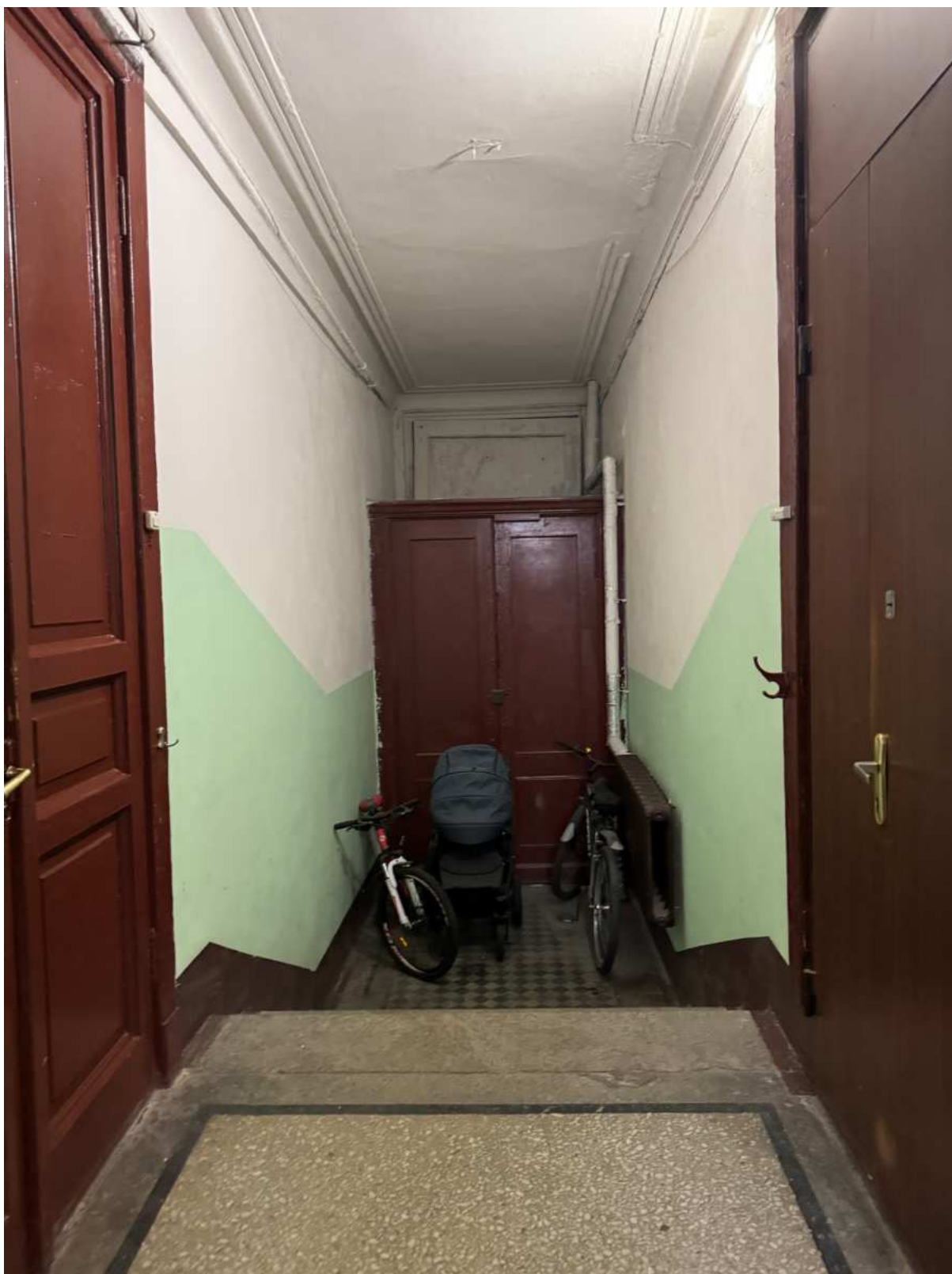
44. Интерьеры в части лестницы 2ЛК объекта культурного наследия.
