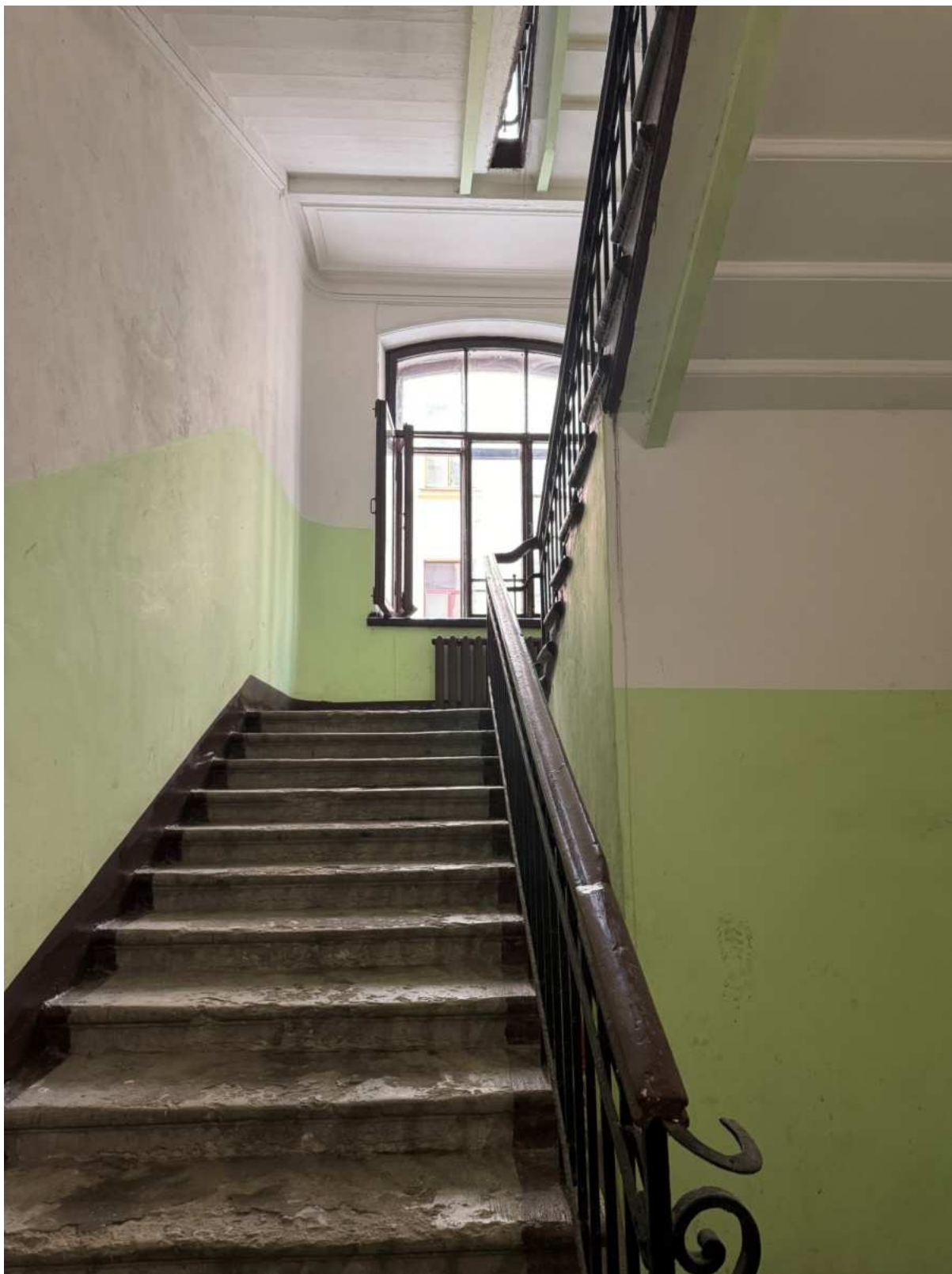
92. Интерьеры в части лестницы 6ЛК объекта культурного наследия.
