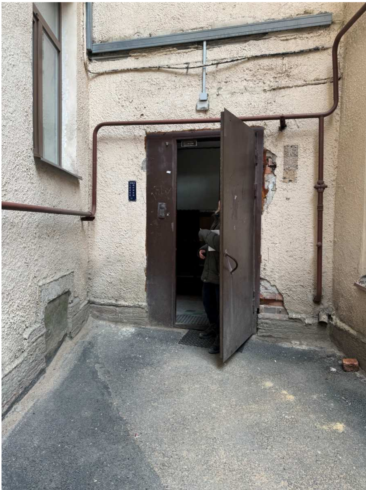
52. Вход с дворового фасада в помещения лестницы ЗЛК объекта культурного наследия.
