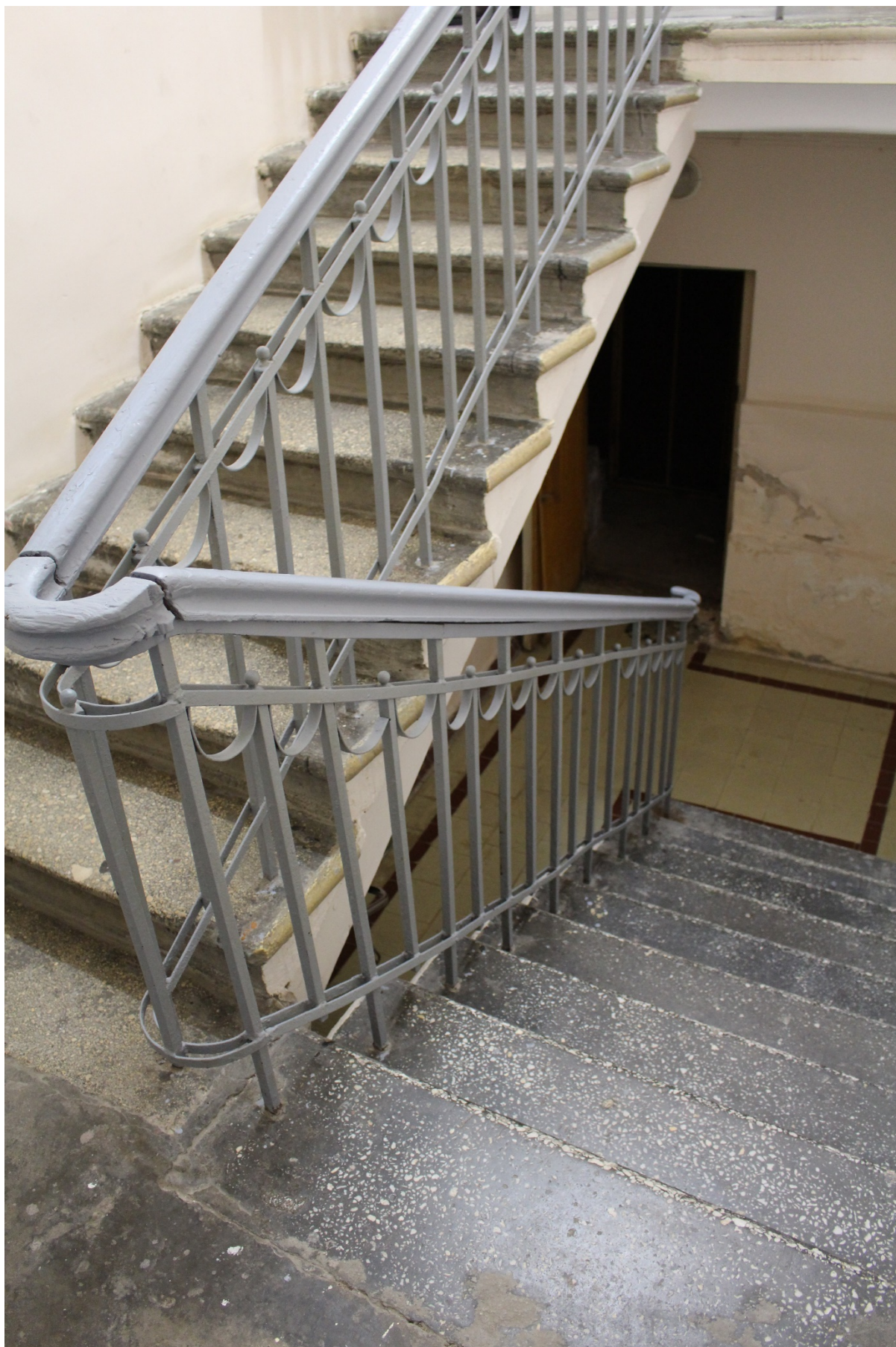
Фото 26. Вид на южную лестницу (помещение 1-Н(18) с междуэтажной площадки выявленного объекта культурного наследия «Здание Общества железопрокатного и проволочного заводов (с металлическими оградами)».
