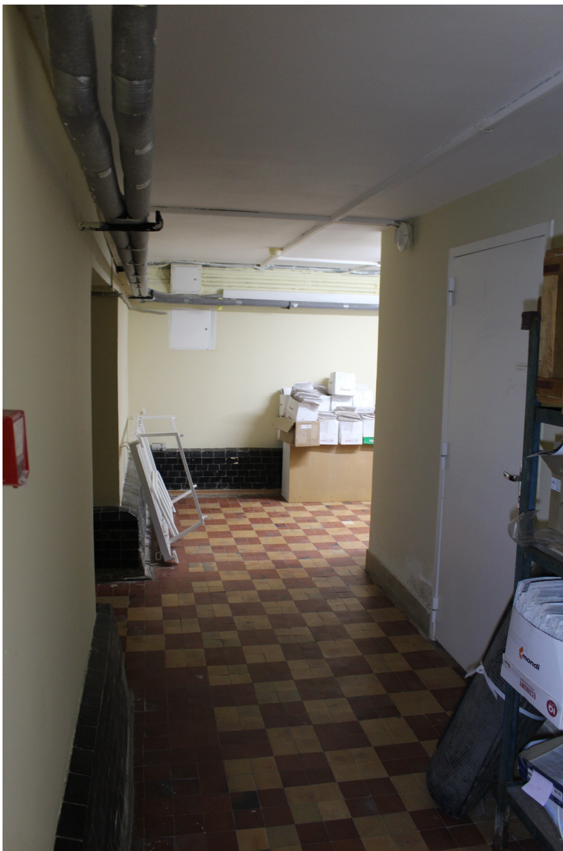
Фото 28. Интерьер внутренних помещений подвального этажа (помещение 1-Н(141) выявленного объекта культурного наследия «Здание Общества железопрокатного и проволочного заводов (с металлическими оградами)»).
