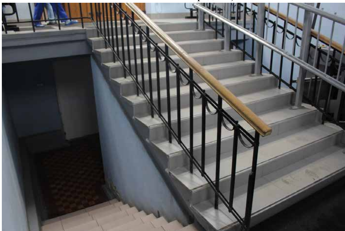
Фото 13. Выявленный объект культурного наследия «Здание Общества железопрокатного и проволочного заводов (с металлическими оградами)». Вид на северо-восточную лестницу (помещение 1-Н(1)).
