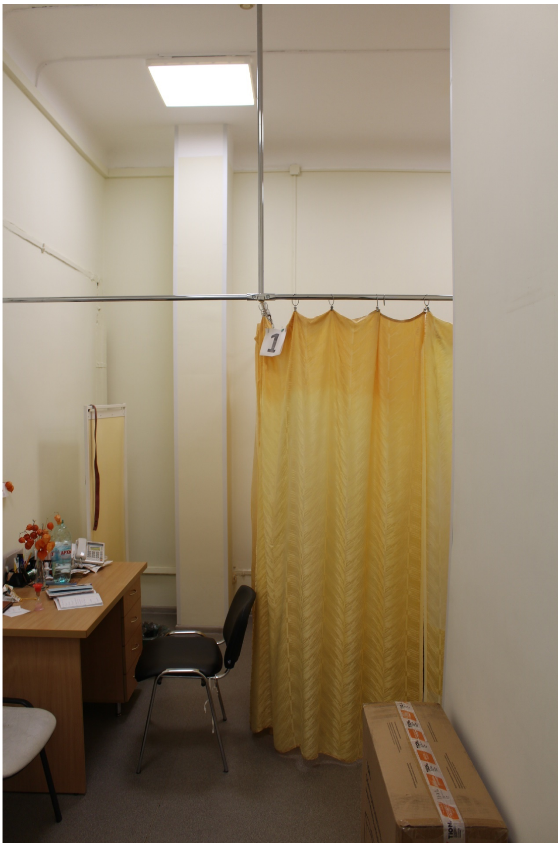
Фото 56. Интерьер типового кабинета в уровне 3-го этажа (помещение 1-Н(99) выявленного объекта культурного наследия «Здание Общества железопрокатного и проволочного заводов (с металлическими оградами)»).
