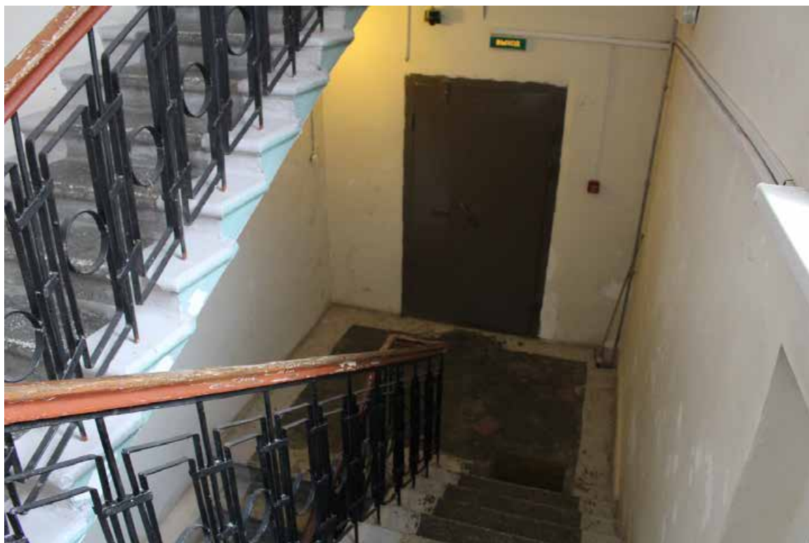
Фото 43. Вид на западную лестницу в уровне 1-го этажа (помещение 1-Н(29) выявленного объекта культурного наследия «Здание Общества железопрокатного и проволочного заводов (с металлическими оградами)»).
