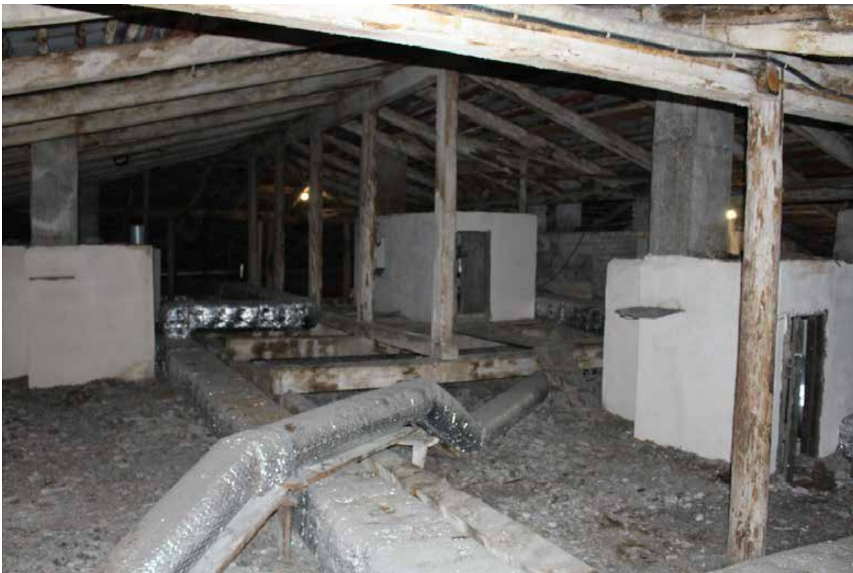
Фото 62. Чердачные помещения выявленного объекта культурного наследия «Здание Общества железопрокатного и проволочного заводов (с металлическими оградами)».
