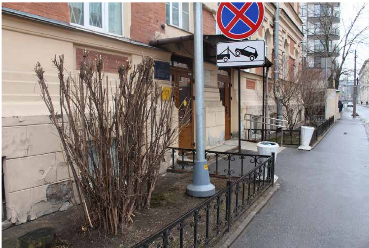
Фото 3. Вид на фасад в уровне 1-го этажа выявленного объекта культурного наследия «Здание Общества железопрокатного и проволочного заводов (с металлическими оградами)».
