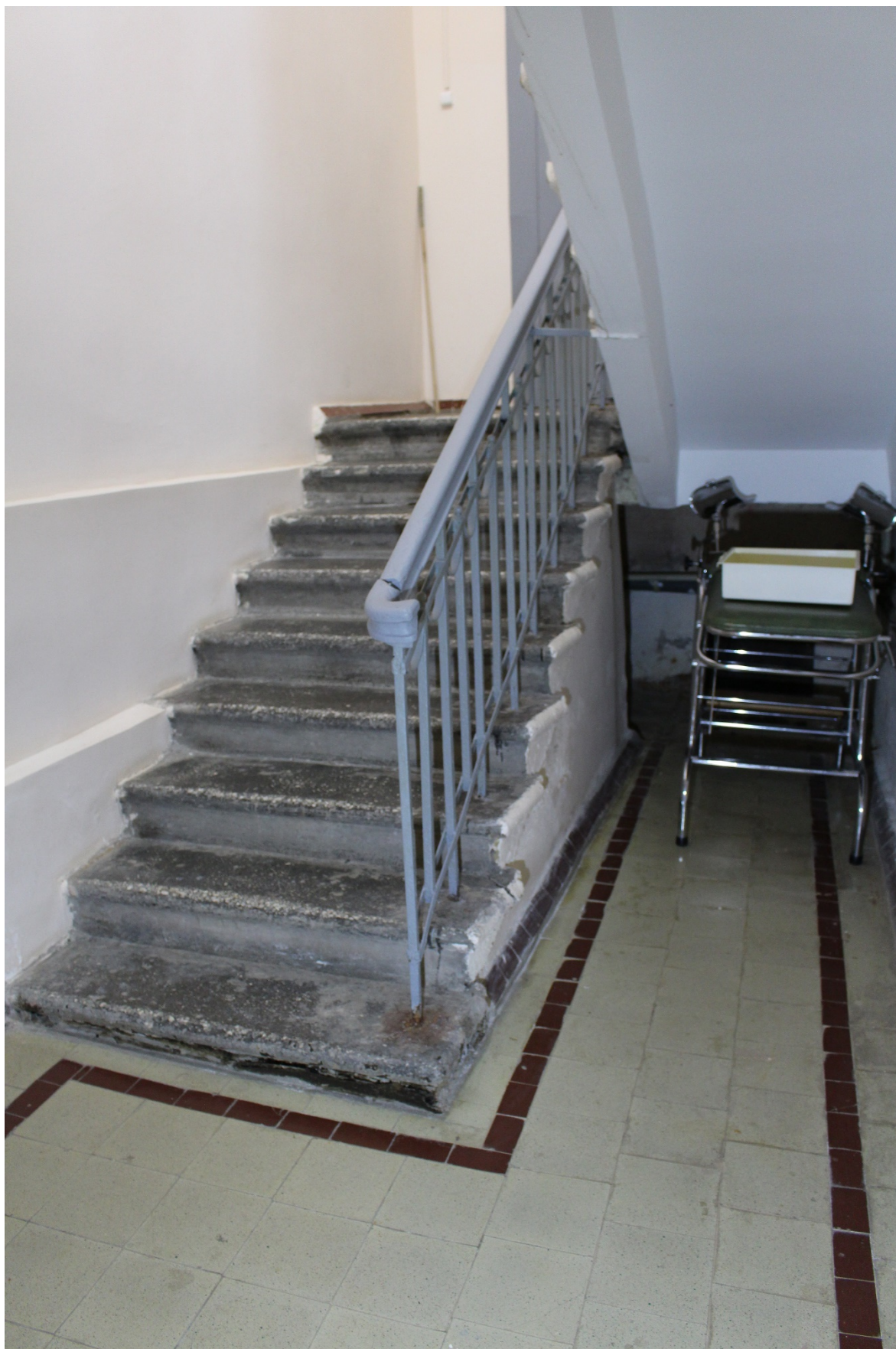
Фото 27. Вид на южную лестницу в уровне подвального этажа (помещение 1-Н(171) выявленного объекта культурного наследия «Здание Общества железопрокатного и проволочного заводов (с металлическими оградами)».
