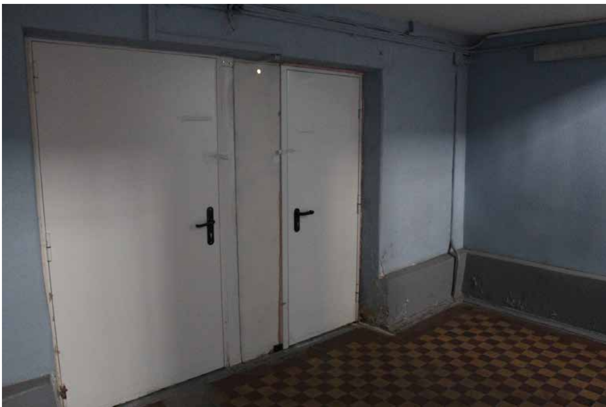
Фото 14. Выявленный объект культурного наследия «Здание Общества железопрокатного и проволочного заводов (с металлическими оградами)». Подвальный этаж. Помещение 1-Н(155).
