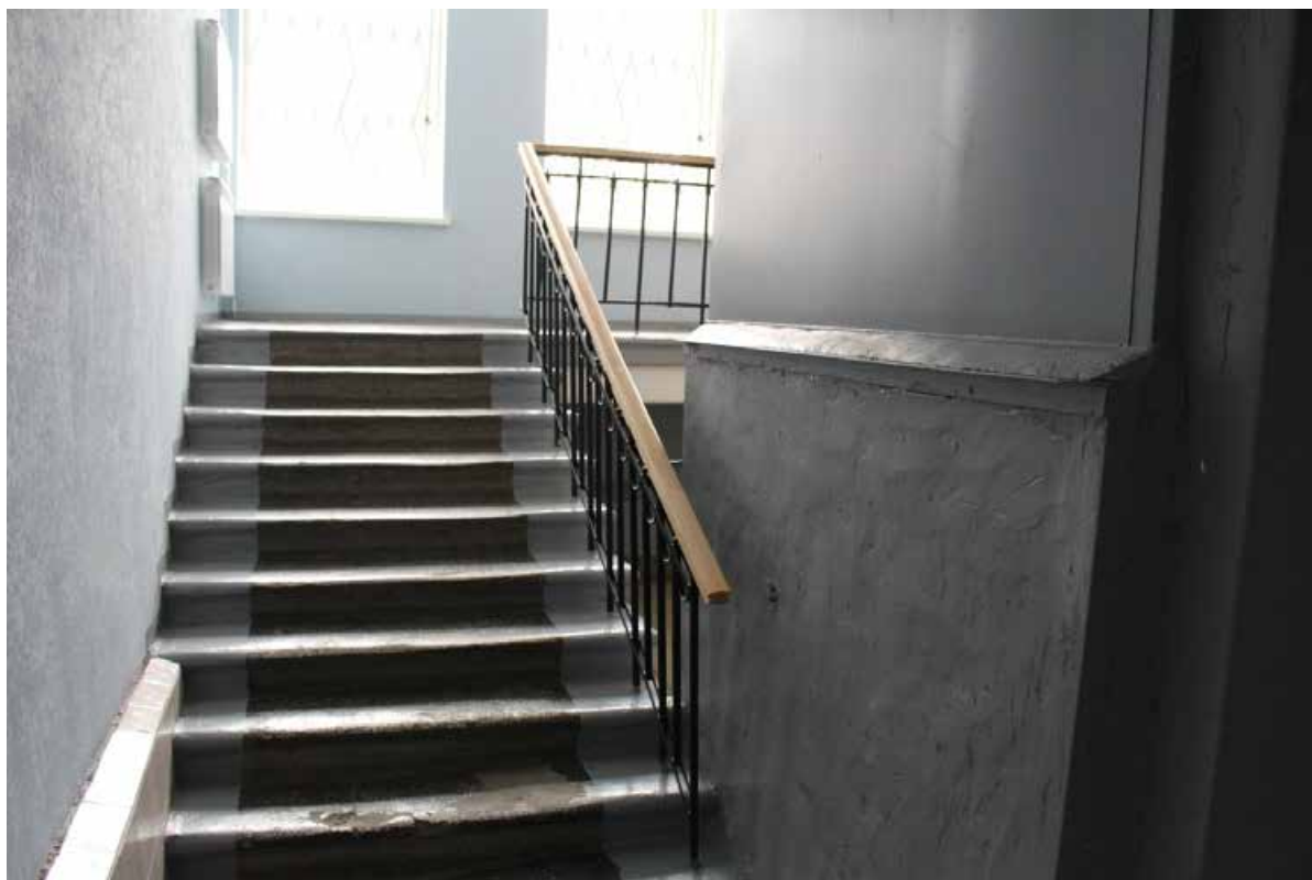
Фото 33. Вид на главную лестницу в центральной части Ш-образного объема в уровне подвального этажа (помещение 1-Н(140) выявленного объекта культурного наследия «Здание Общества железопрокатного и проволочного заводов (с металлическими оградами)»).
