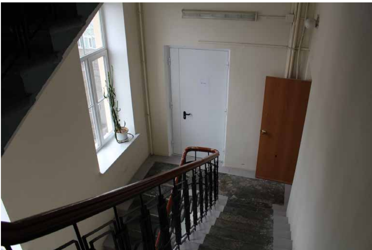
Фото 48. Вид на западную лестницу в уровне 4-го этажа (помещение 1-Н(117) выявленного объекта культурного наследия «Здание Общества железопрокатного и проволочного заводов (с металлическими оградами)»).
