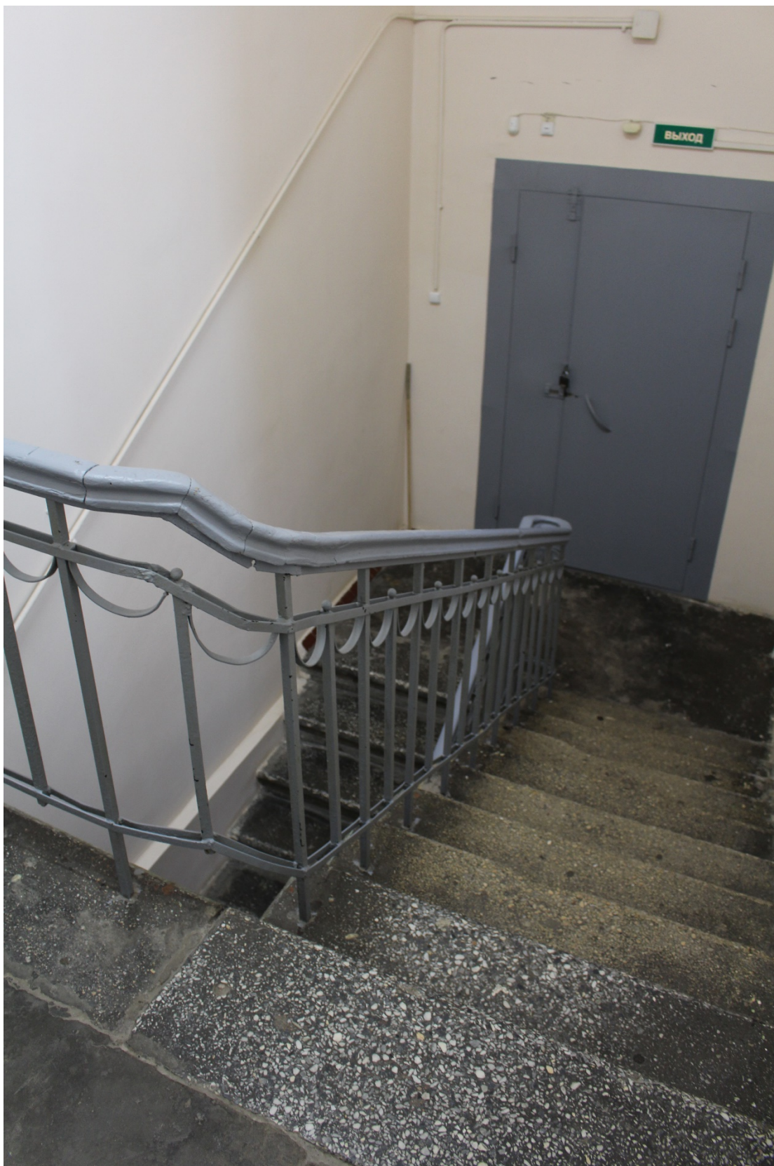
Фото 24. Вид на южную лестницу (помещение 1-Н(18) выявленного объекта культурного наследия «Здание Общества железопрокатного и проволочного заводов (с металлическими оградами)».
