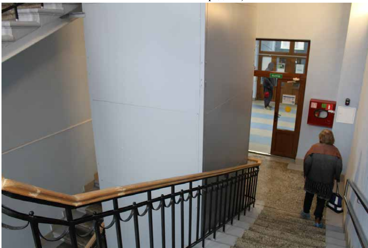
Фото 36. Вид на главную лестницу в центральной части Ш-образного объема в уровне 1-го этажа (помещение 1-Н(20) выявленного объекта культурного наследия «Здание Общества железопрокатного и проволочного заводов (с металлическими оградами)»).
