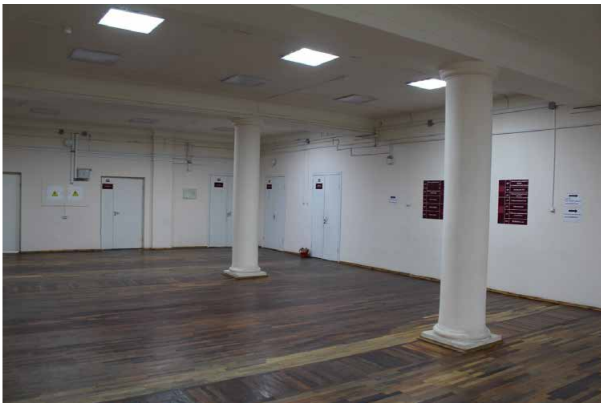
Фото 58. Интерьер внутренних помещений в уровне 4-го этажа (помещение 1-Н(111) выявленного объекта культурного наследия «Здание Общества железопрокатного и проволочного заводов (с металлическими оградами)»).
