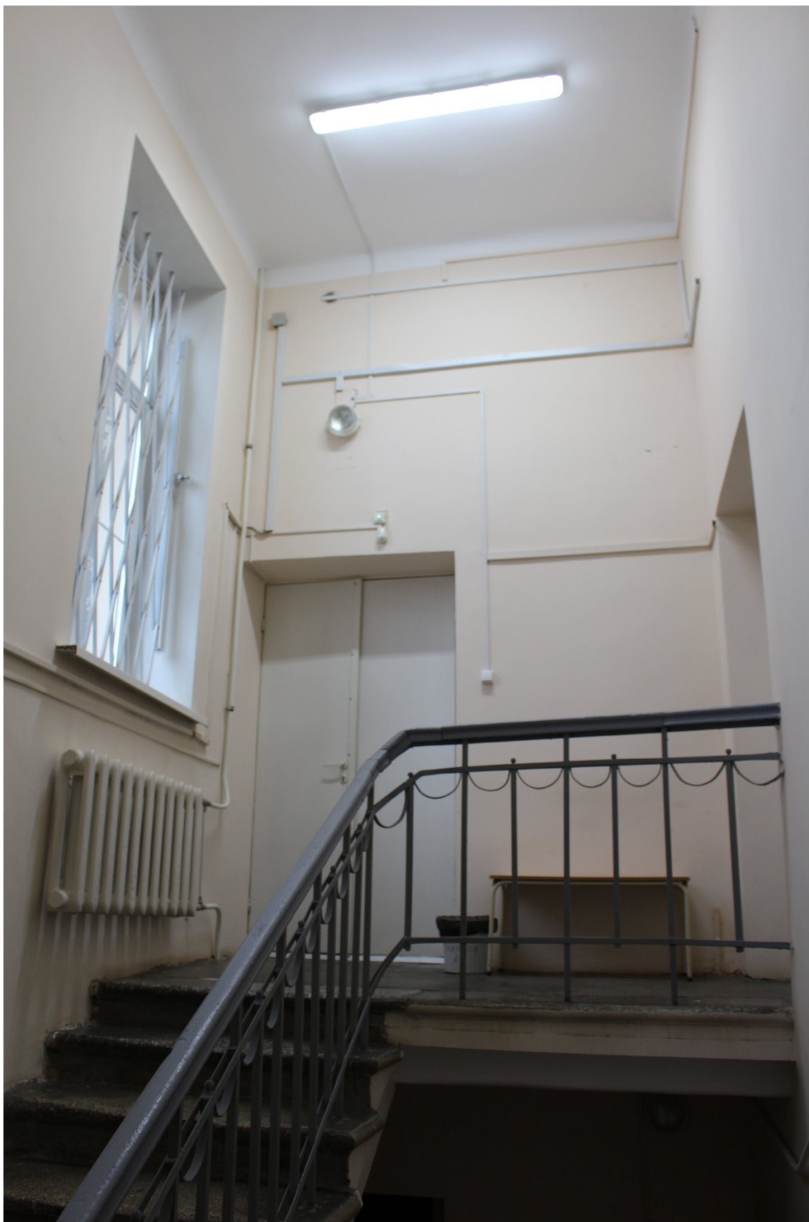
Фото 25. Вид на южную лестницу в уровне 1-го этажа (помещение 1-Н(18)) выявленного объекта культурного наследия «Здание Общества железопрокатного и проволочного заводов (с металлическими оградами)».
