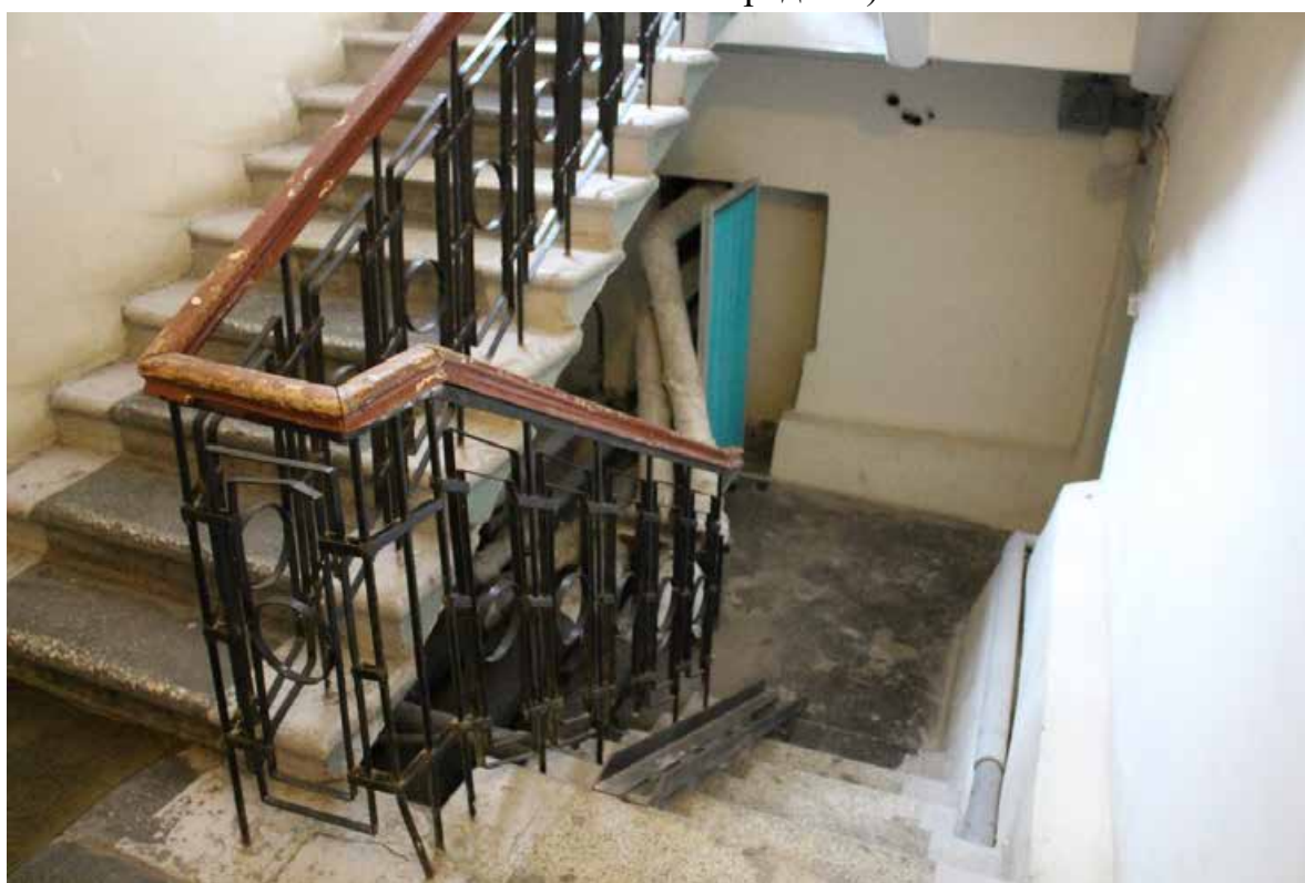
Фото 42. Вид на западную лестницу в уровне подвального этажа (помещение 1-Н(149) выявленного объекта культурного наследия «Здание Общества железопрокатного и проволочного заводов (с металлическими оградами)»).
