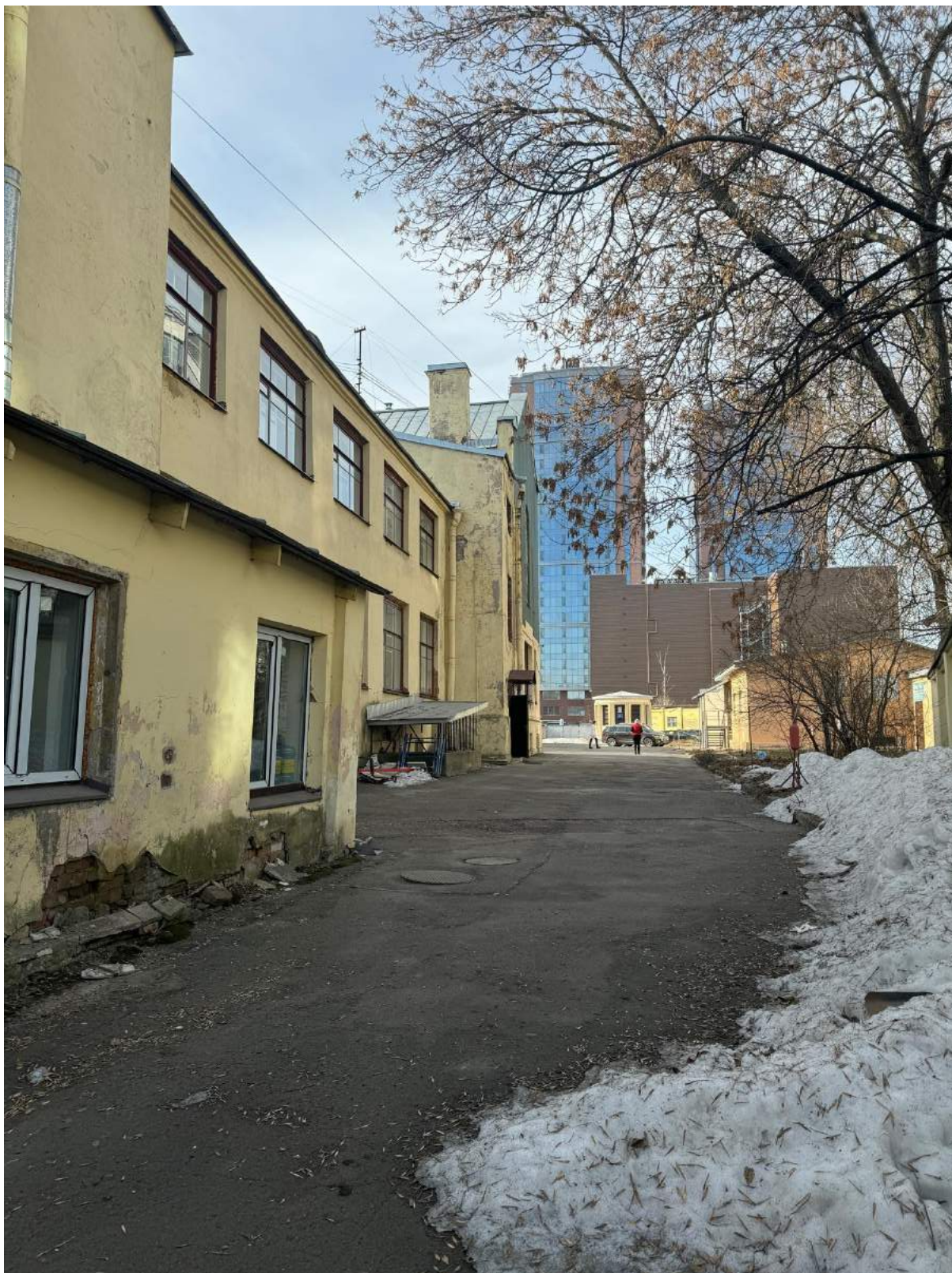
11. Фрагмент дворового фасада объекта культурного наследия «Главное здание» с дворовой территории.
