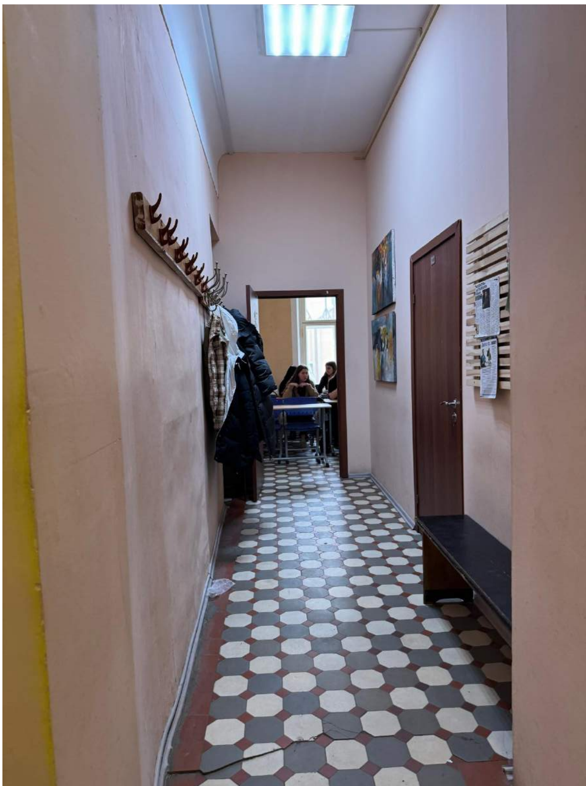
63. Вид на помещение 1-Н(12) выявленного объекта культурного наследия «Главное здание».
