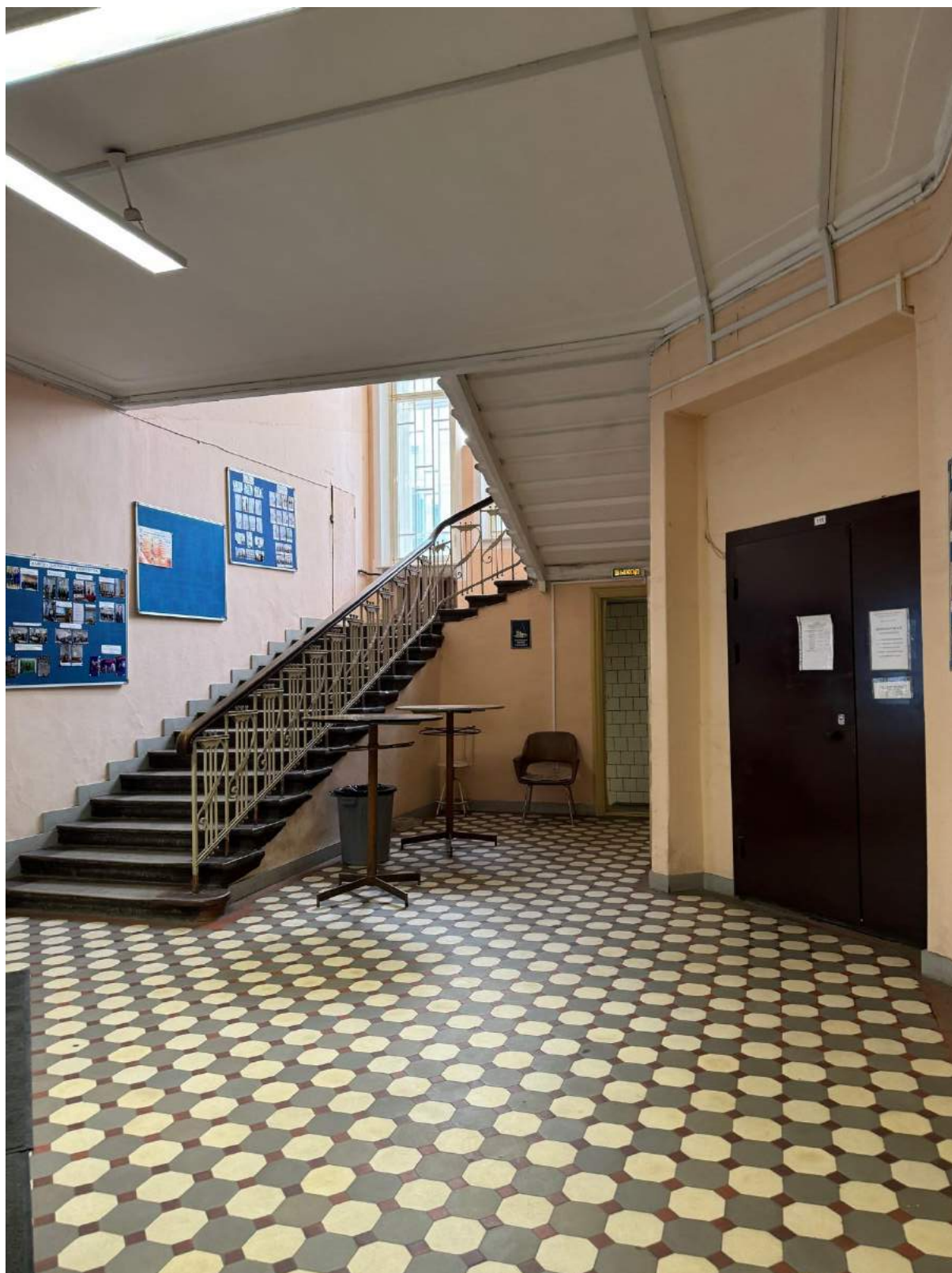
53. Вестибюль и главная лестница 1-Н(2) выявленного объекта культурного наследия «Главное здание».
