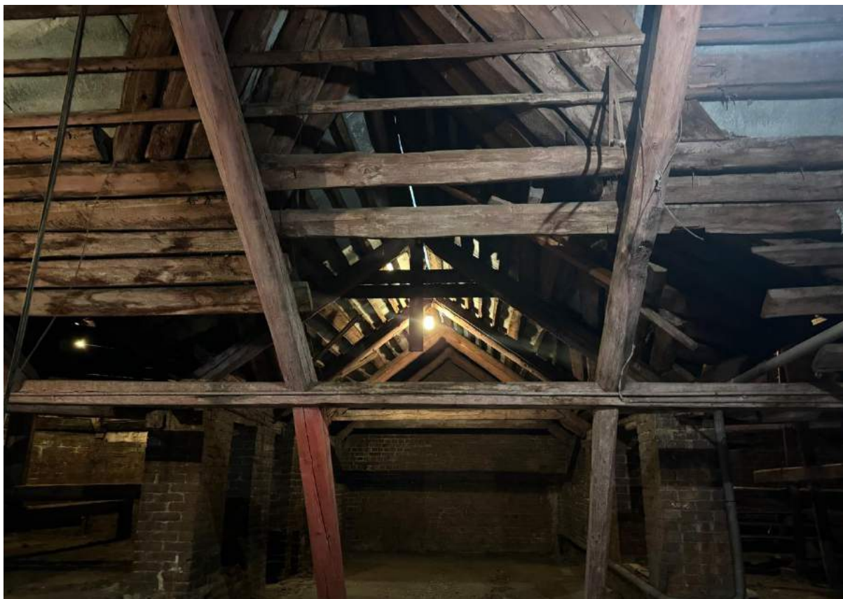
84. Вид на чердачное помещение выявленного объекта культурного наследия «Главное здание».
