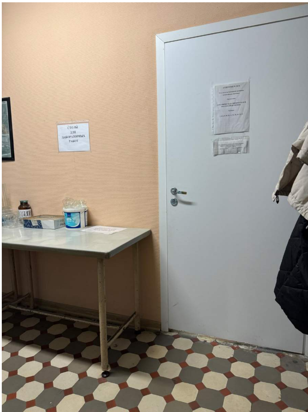
61. Вид на помещение 1-Н(12) выявленного объекта культурного наследия «Главное здание».
