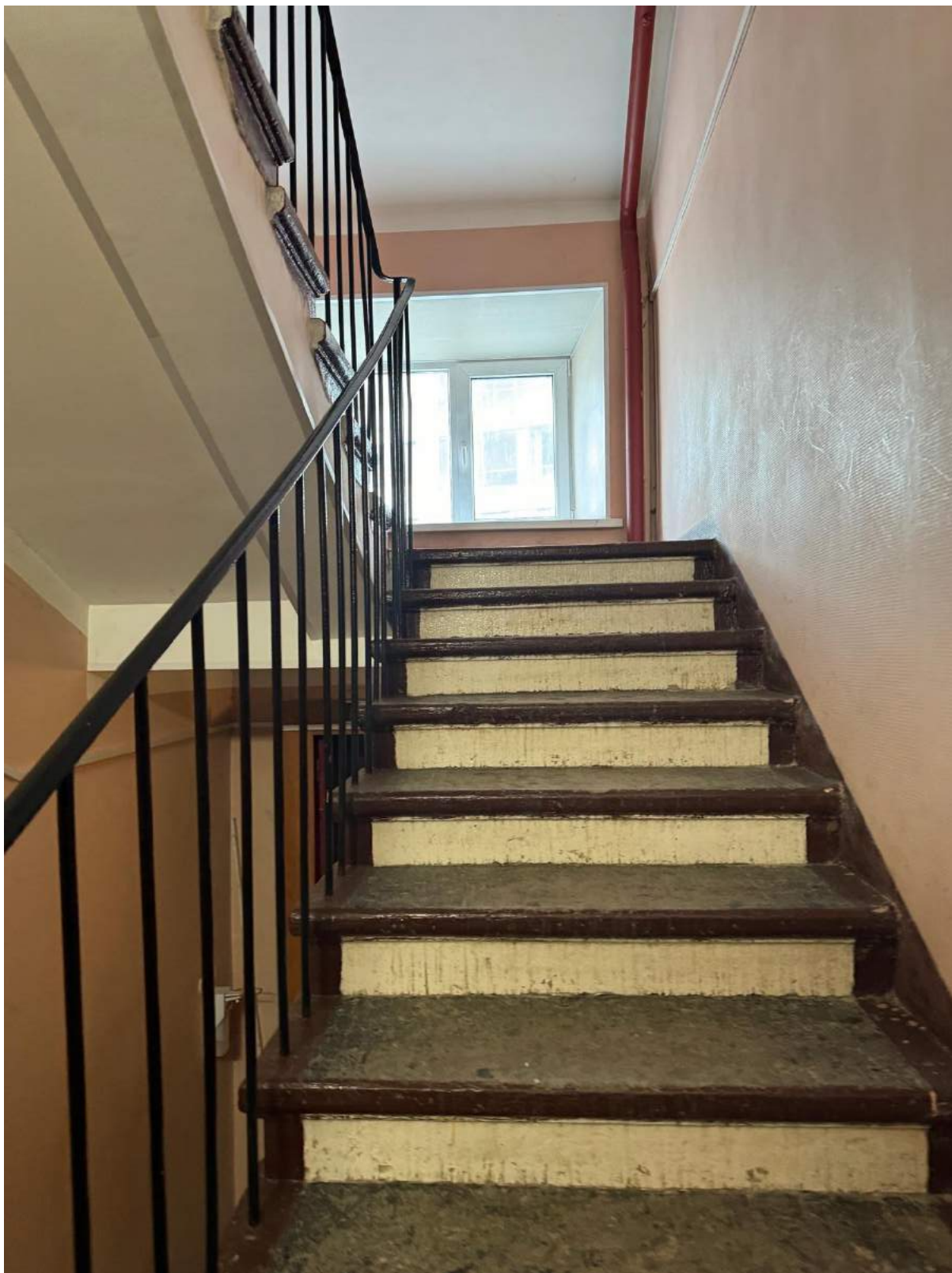
39.Общий вид лестницы 6-Н выявленного объекта культурного наследия «Жилой дом».
