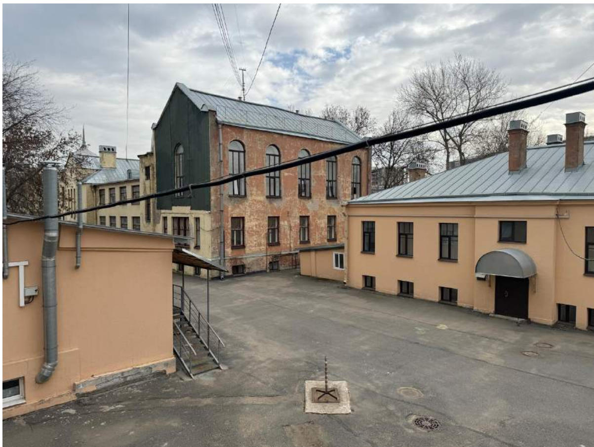
12. Вид на территорию выявленного объекта культурного наследия «Комплекс построек Бактериологической лаборатории Ветеринарного управления МВД (с оградой)» и объекты, входящие в его состав: «Главное здание» и «Жилой дом».
