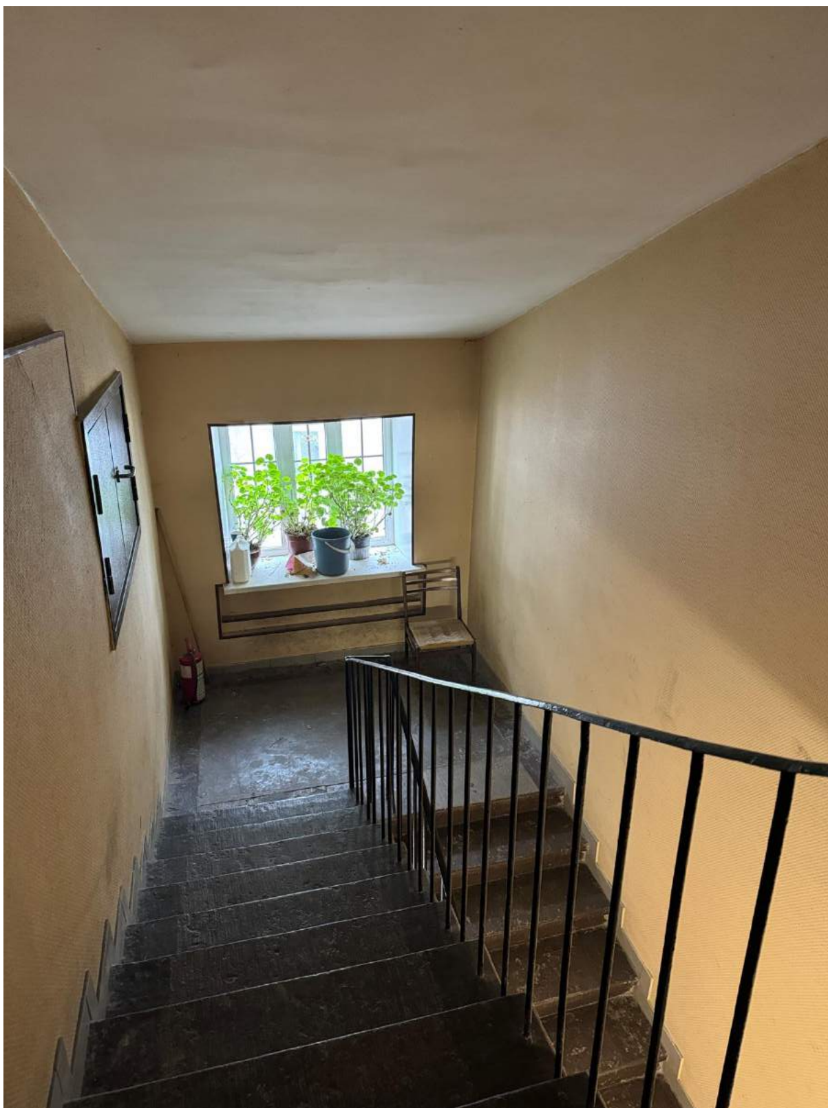
89. Вид на лестницу в помещении 1-Н(47) выявленного объекта культурного наследия «Главное здание».
