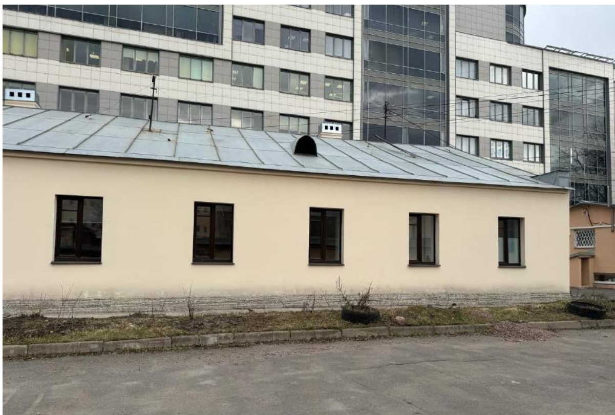
28. Фрагмент фасада объекта культурного наследия «Корпус для подопытных животных» с дворовой территории.
