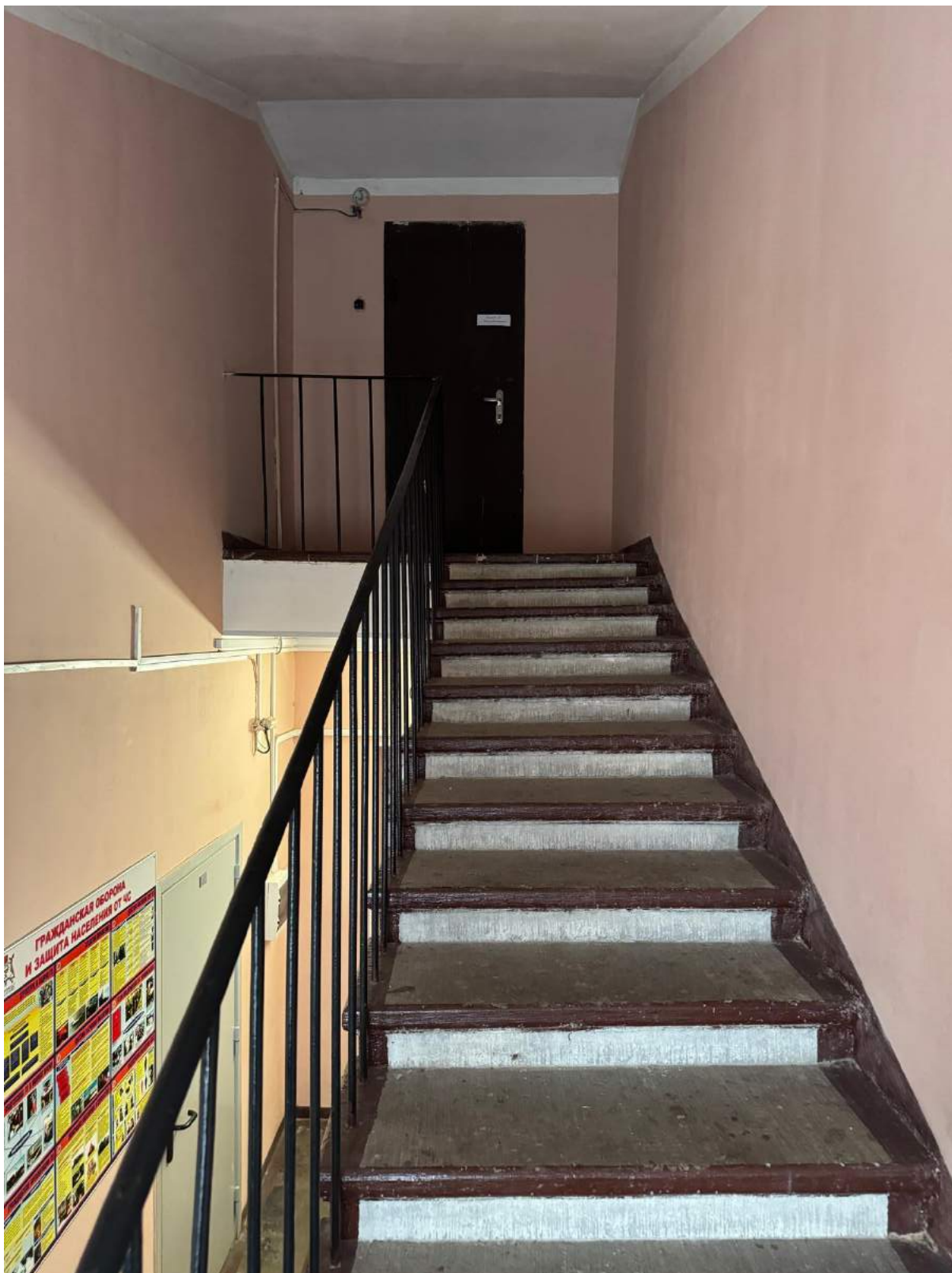
41. Общий вид лестницы 6-Н выявленного объекта культурного наследия «Жилой дом».
