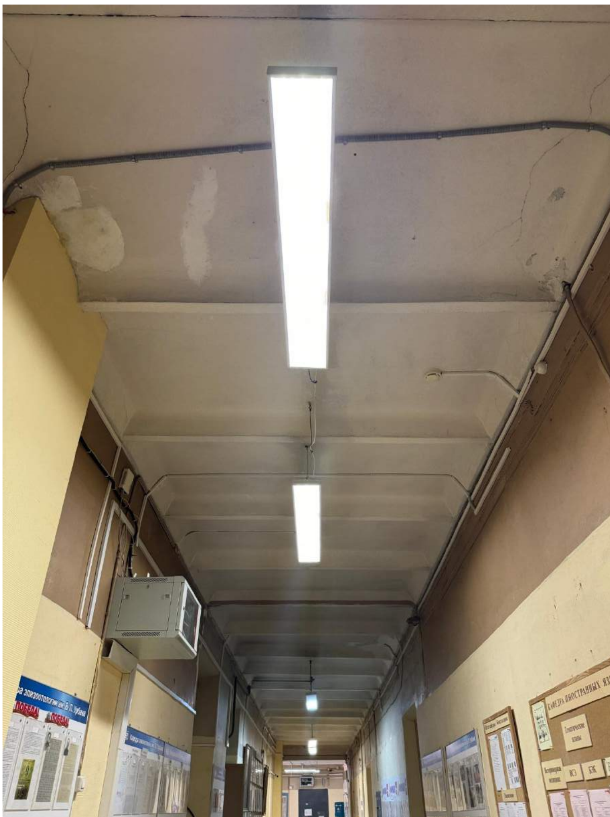
71. Вид на помещение 1-Н(33) выявленного объекта культурного наследия «Главное здание».
