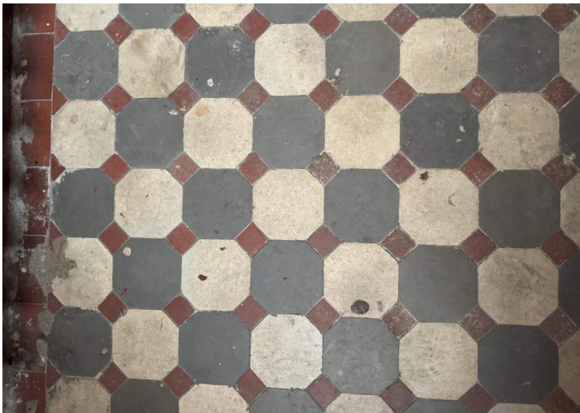
37. Покрытие пола метлахской плиткой тамбура выявленного объекта культурного наследия «Жилой дом».
