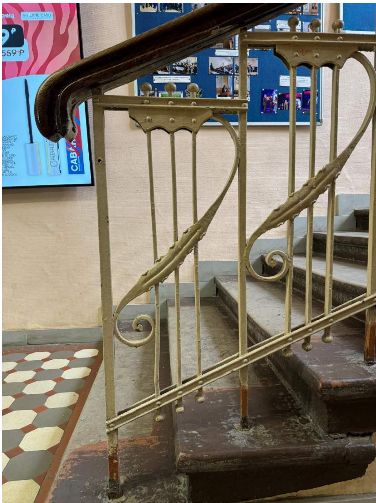
56. Фрагмент ограждения главной лестницы 1-Н(2) выявленного объекта культурного наследия «Главное здание».
