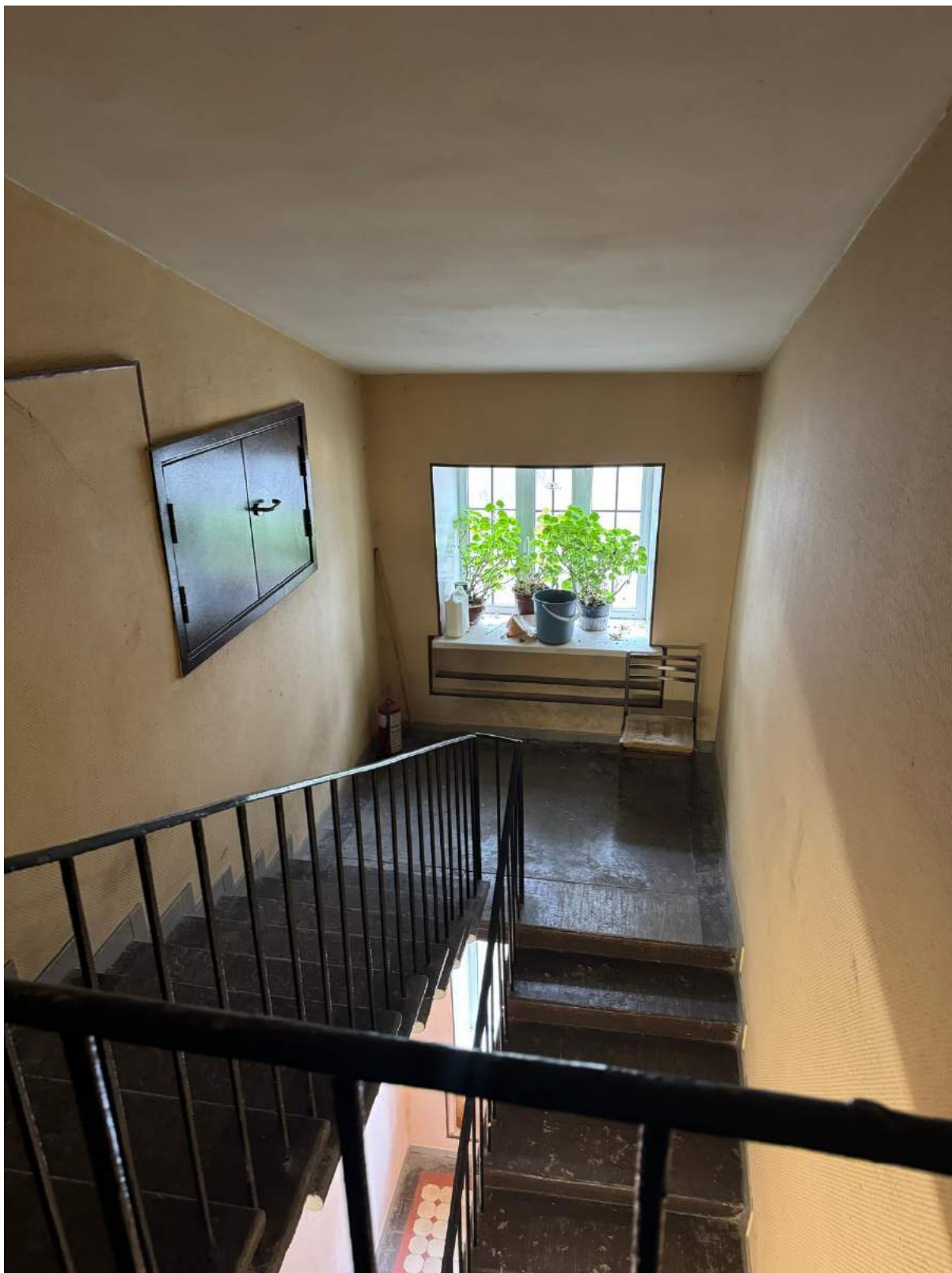
80. Вид на лестницу в помещении 1-Н(47) выявленного объекта культурного наследия «Главное здание».
