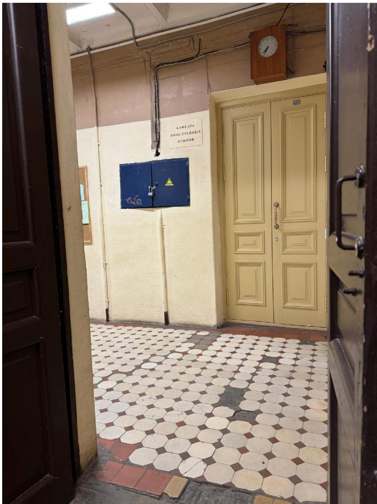
69. Вид на помещение 1-Н(33) выявленного объекта культурного наследия «Главное здание».
