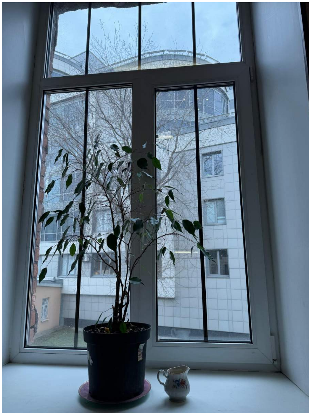
67. Вид на оконное заполнение в части лестницы в помещении 1-Н(16) выявленного объекта культурного наследия «Главное здание».
