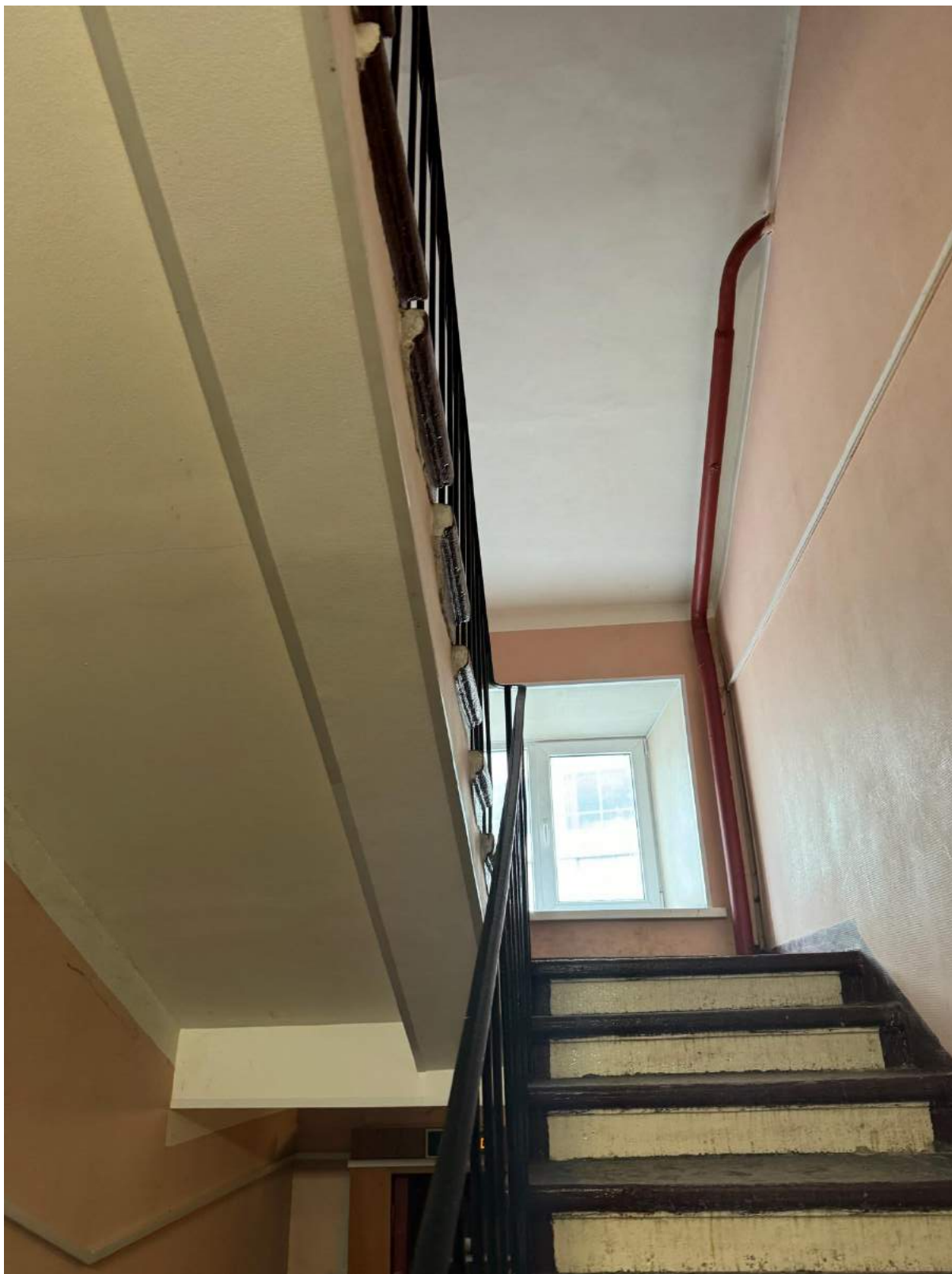
40. Общий вид лестницы 6-Н выявленного объекта культурного наследия «Жилой дом».
