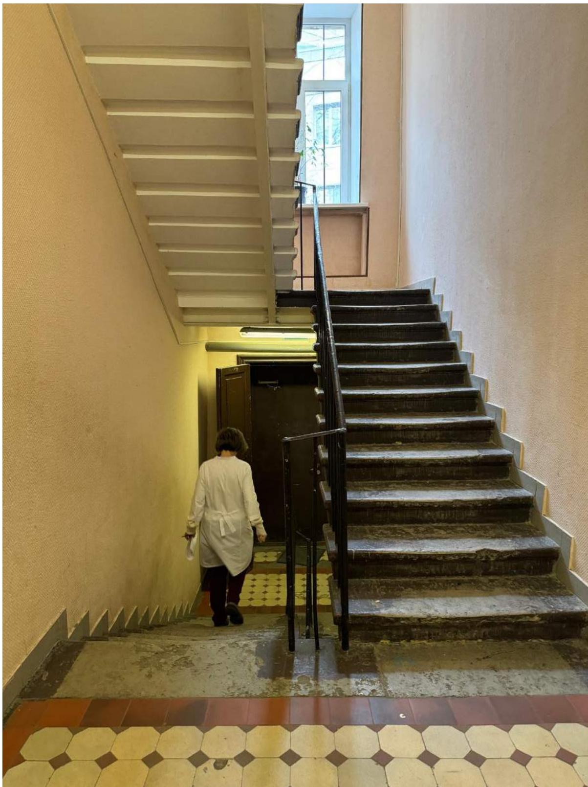
64. Вид на лестницу в помещении 1-Н(16) выявленного объекта культурного наследия «Главное здание».
