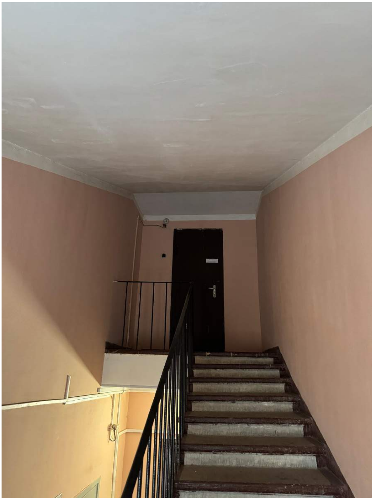
42. Общий вид лестницы 6-Н выявленного объекта культурного наследия «Жилой дом».
