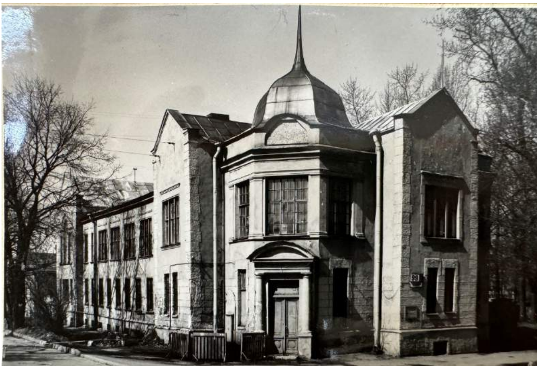
56. Главное здание Бактериологической лаборатории Ветеринарного управления МВД - № б/н - сектор хранения документированной информации Управления организационного обеспечения и контроля КГИОП (архив КГИОП)
