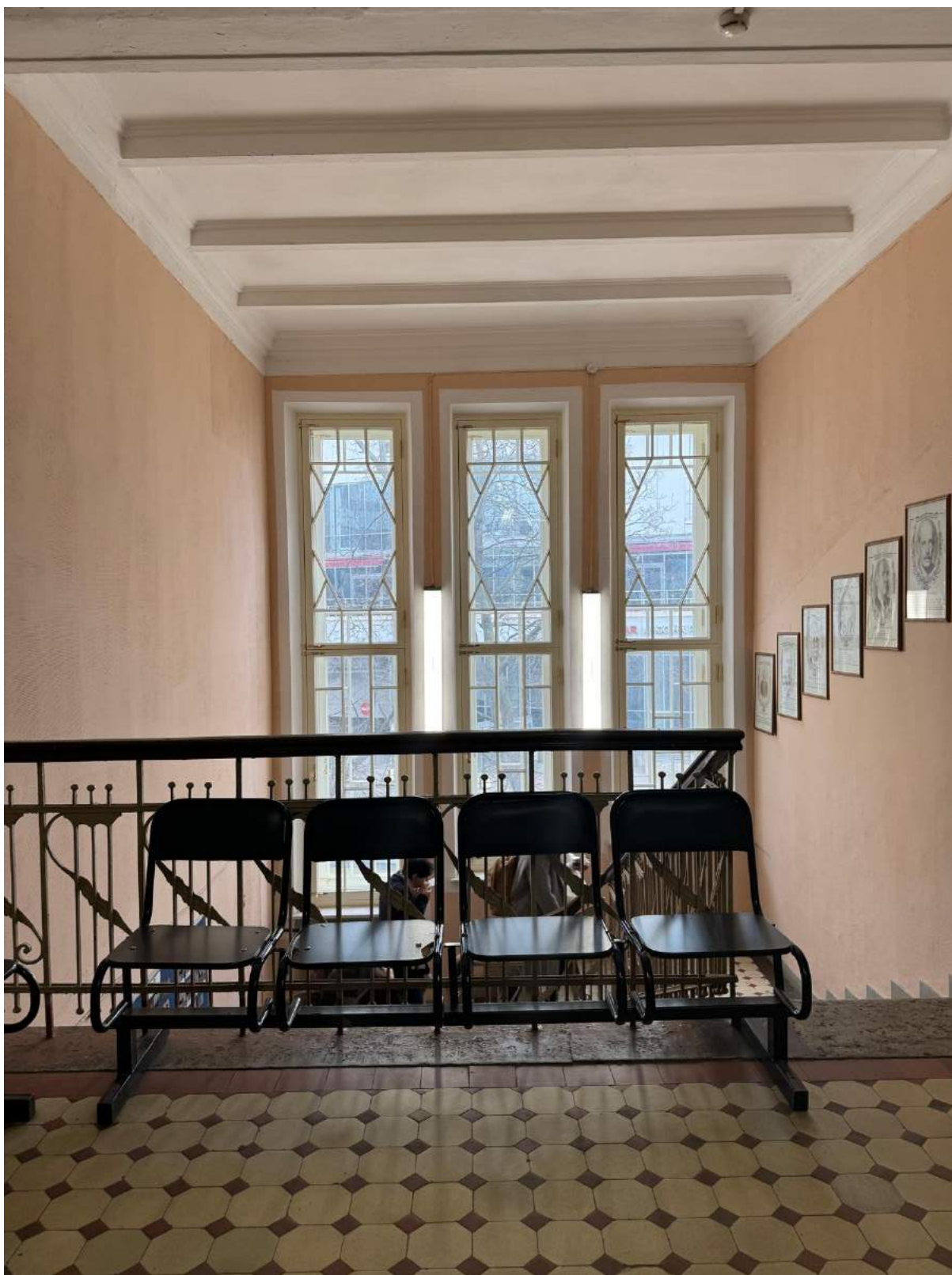
75. Вид на главную лестницу в помещении 1-Н(33) выявленного объекта культурного наследия «Главное здание».
