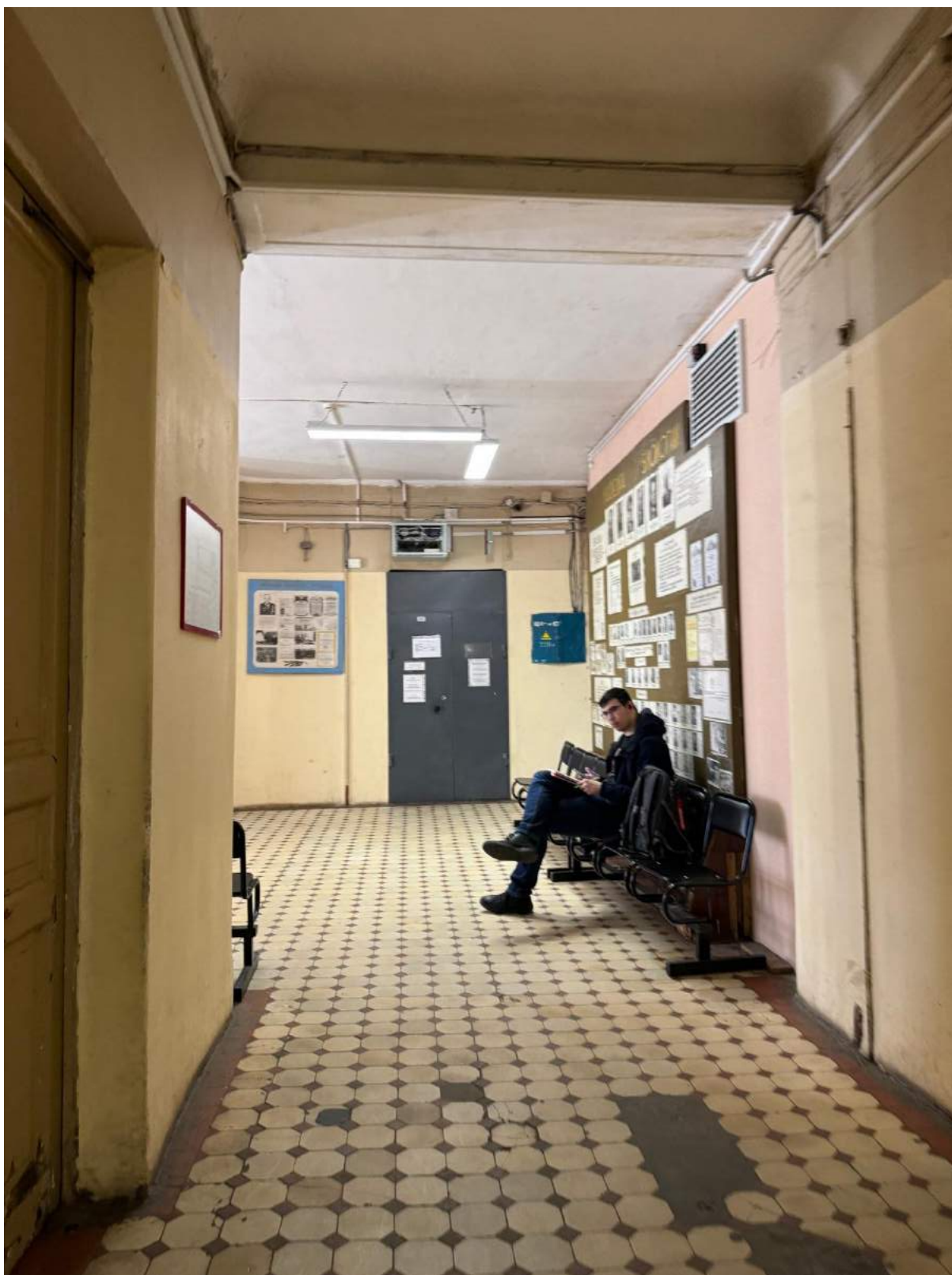
74. Вид на помещение 1-Н(33) выявленного объекта культурного наследия «Главное здание».
