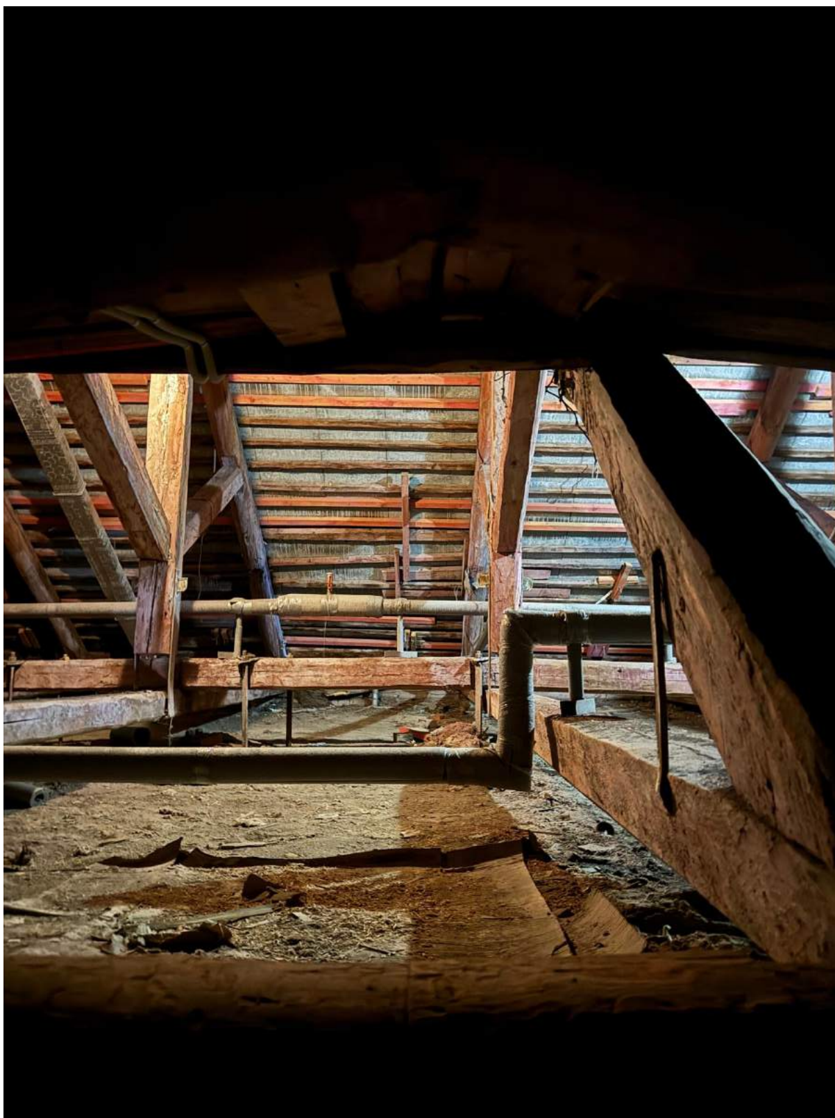
88. Вид на чердачное помещение выявленного объекта культурного наследия «Главное здание».
