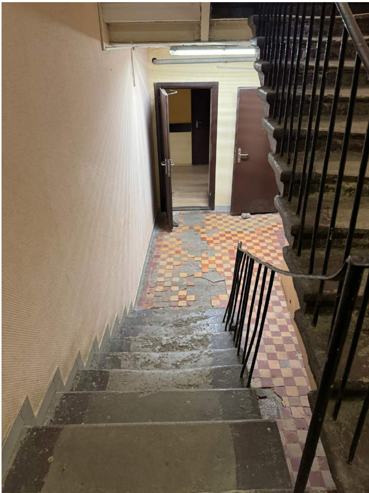
91. Вид на помещение 1-Н(73) выявленного объекта культурного наследия «Главное здание».
