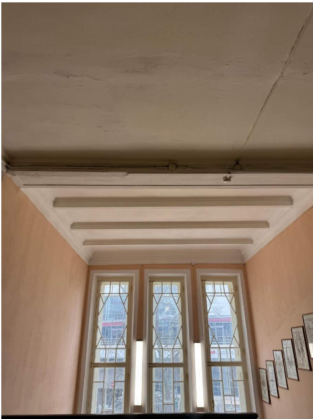
76. Вид на главную лестницу в помещении 1-Н(33) выявленного объекта культурного наследия «Главное здание».
