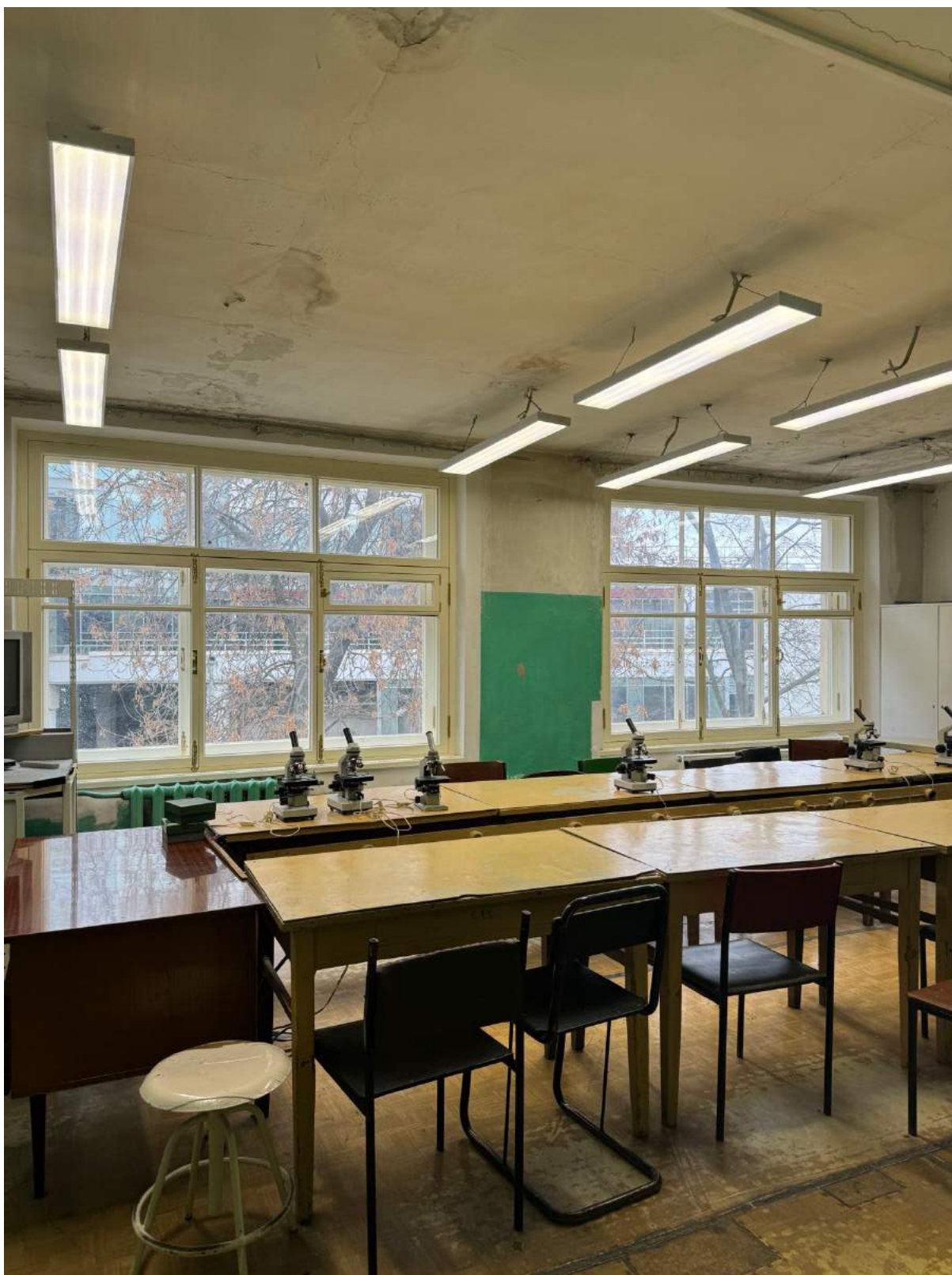
73. Вид на помещение 1-Н(44) выявленного объекта культурного наследия «Главное здание».
