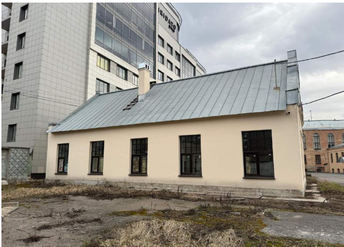
31. Фрагмент фасада объекта культурного наследия «Корпус для подопытных животных» с дворовой территории.
