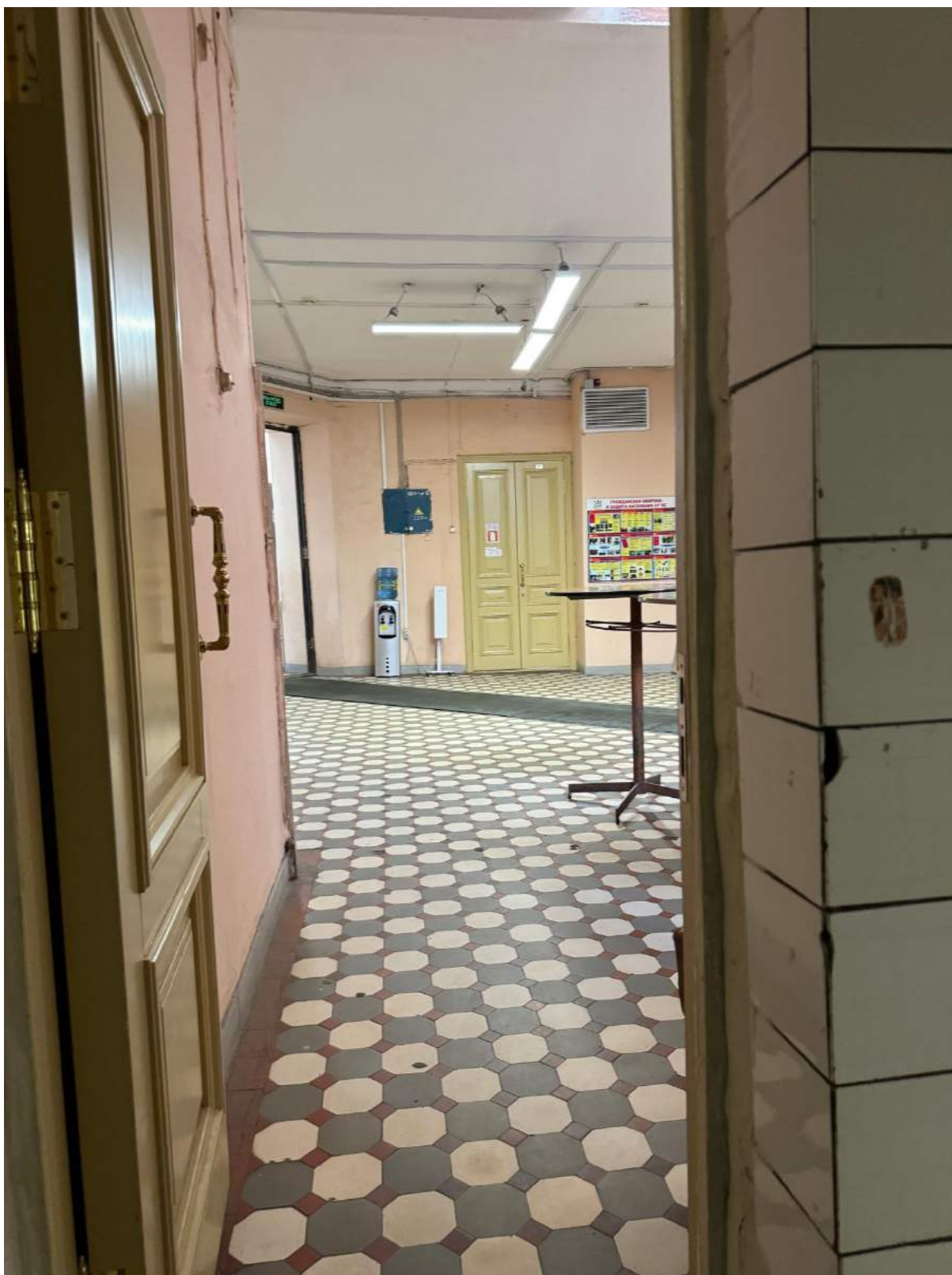
98. Вид на помещение 1-Н(26) выявленного объекта культурного наследия «Главное здание».
