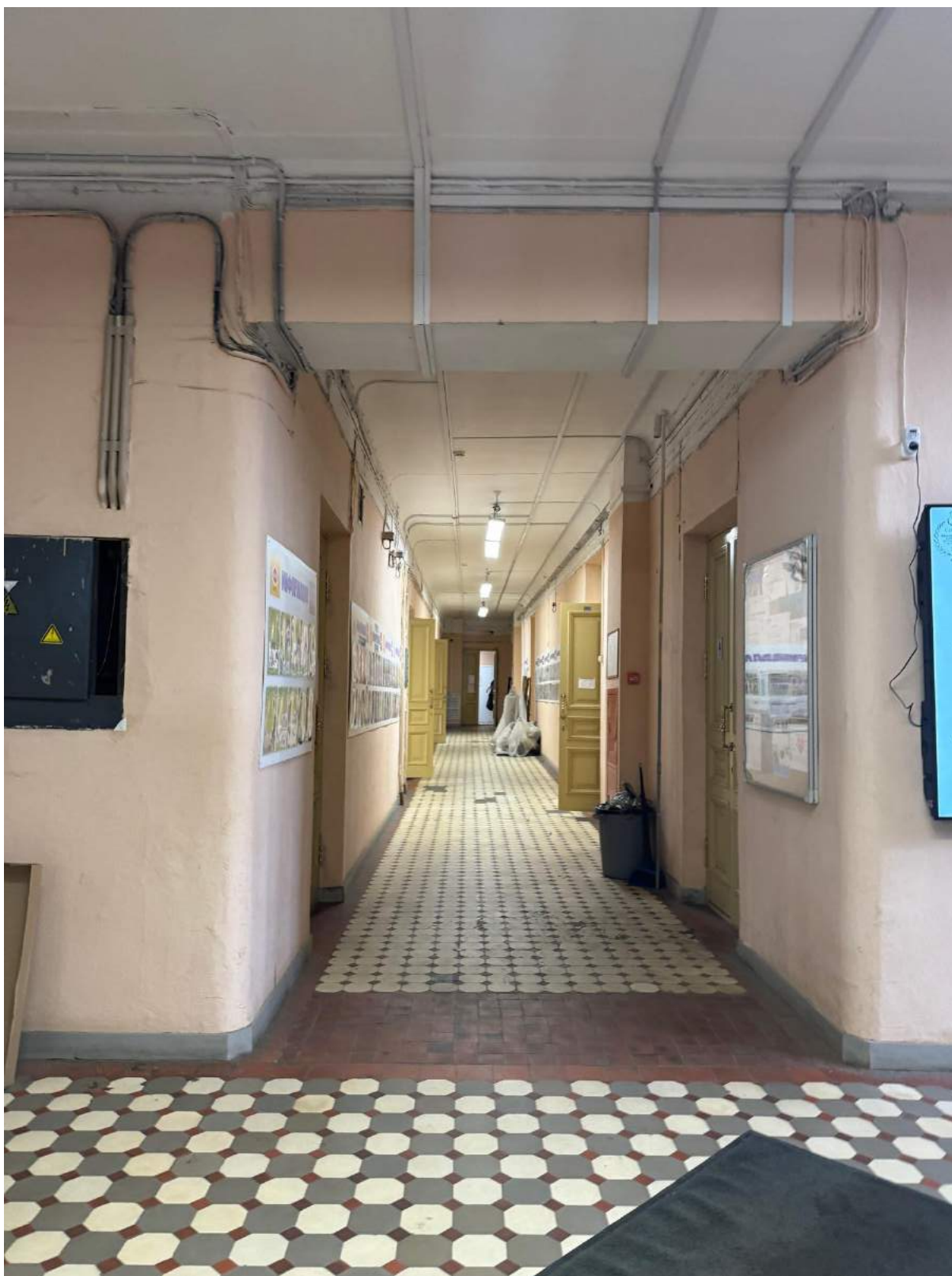
54. Вид на помещение 1-Н(5) выявленного объекта культурного наследия «Главное здание».
