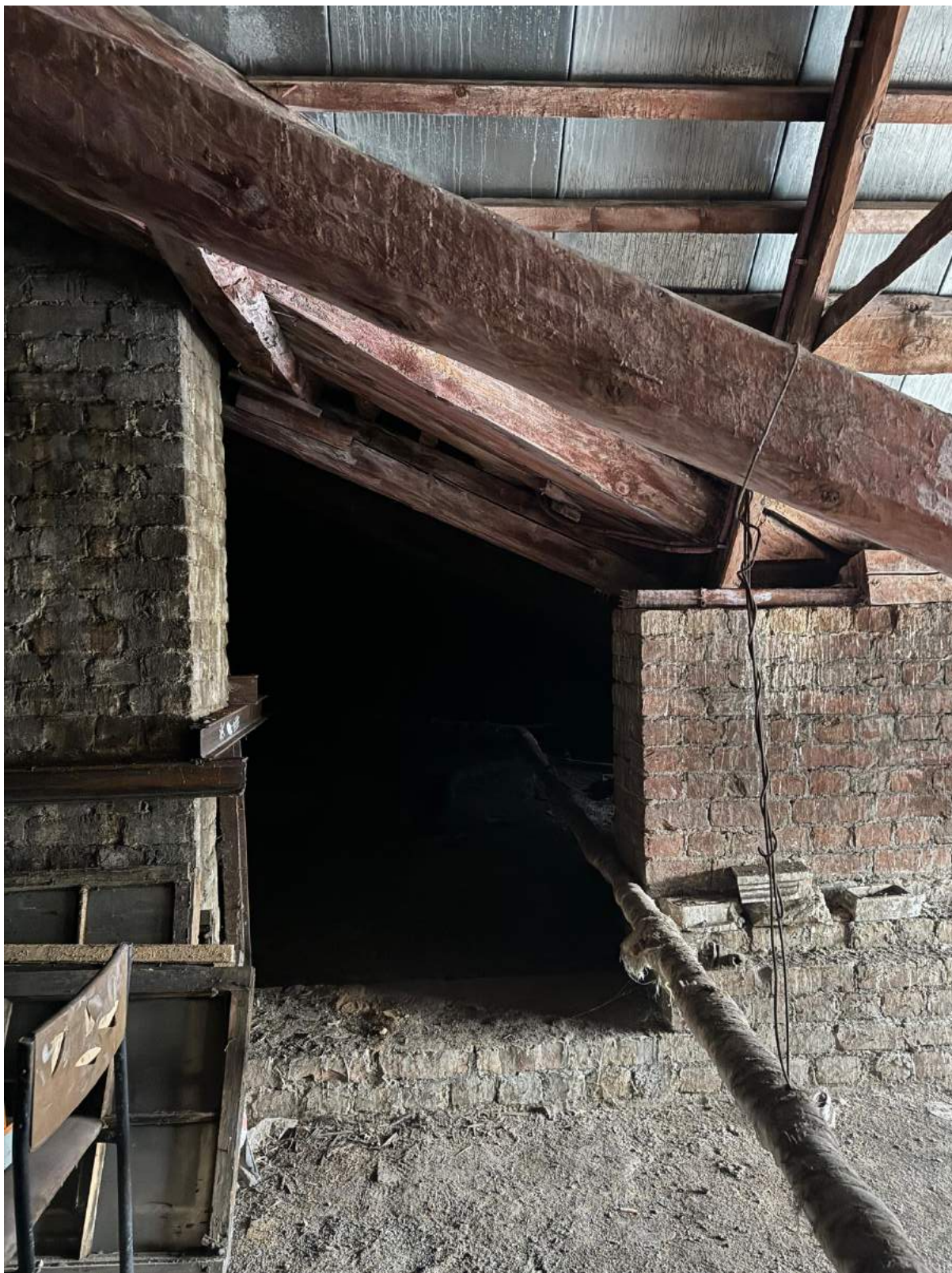
45. Фрагмент чердачного помещения выявленного объекта культурного наследия «Жилой дом».
