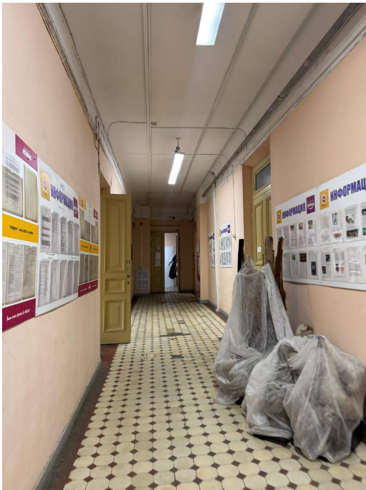
58. Вид на помещение 1-Н(33) выявленного объекта культурного наследия «Главное здание».
