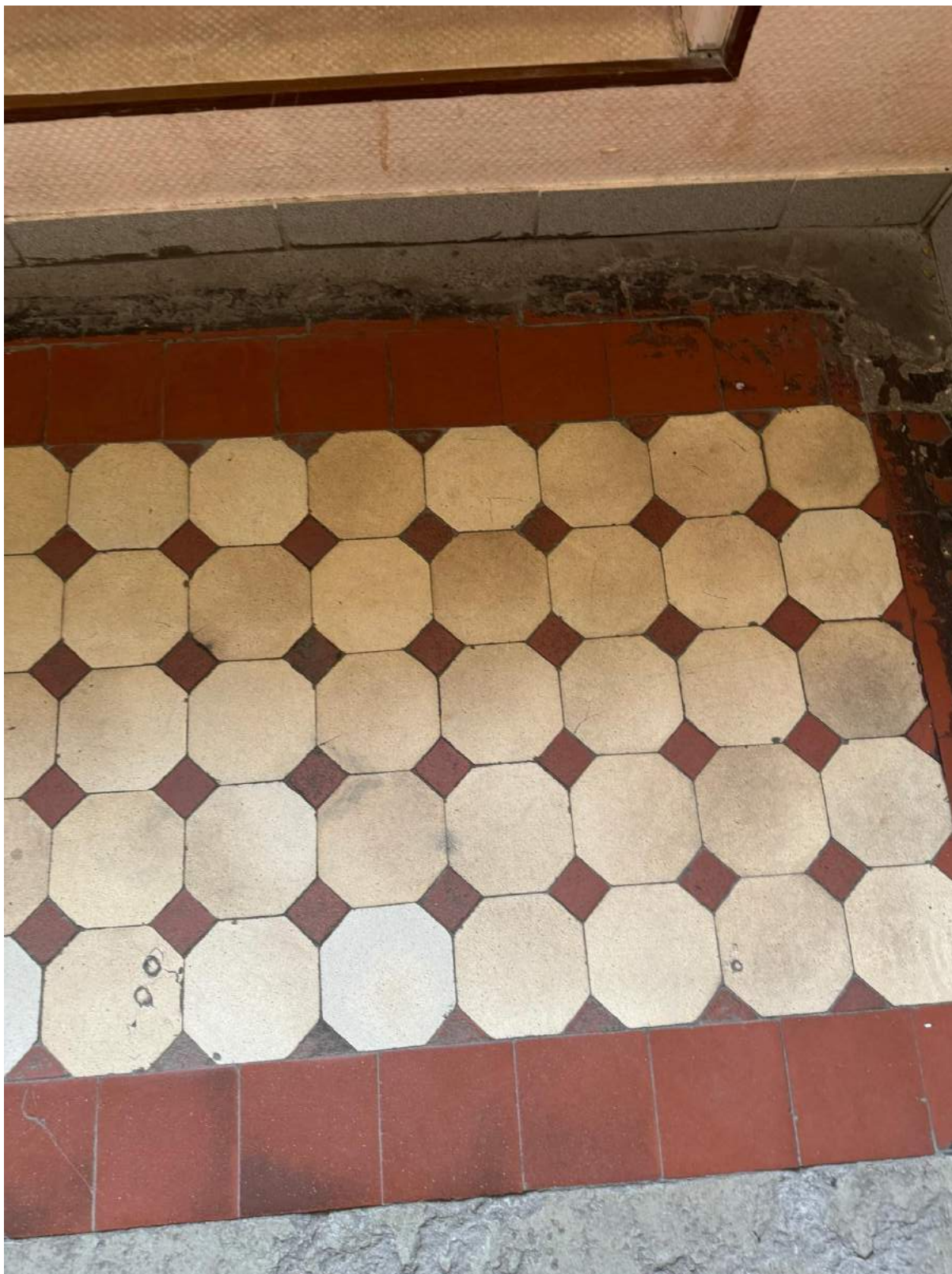
66. Покрытие пола метлахской плиткой в части лестницы в помещении 1-Н(16) выявленного объекта культурного наследия «Главное здание».
