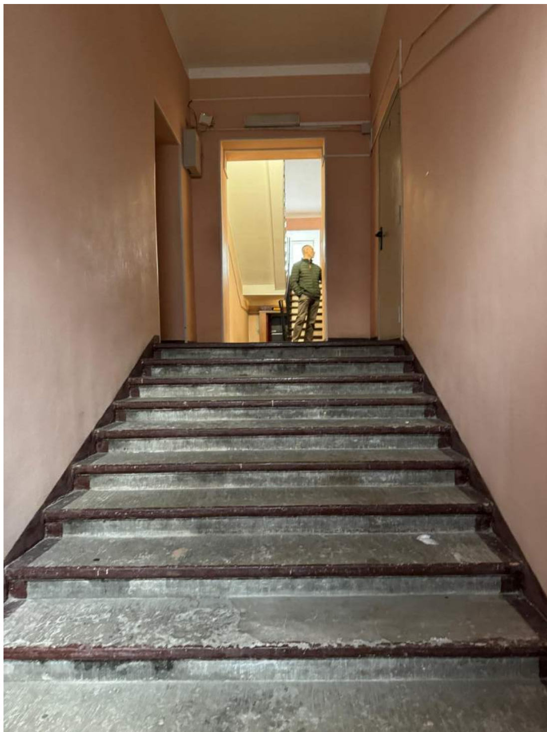
36. Помещение в части лестницы выявленного объекта культурного наследия «Жилой дом».
