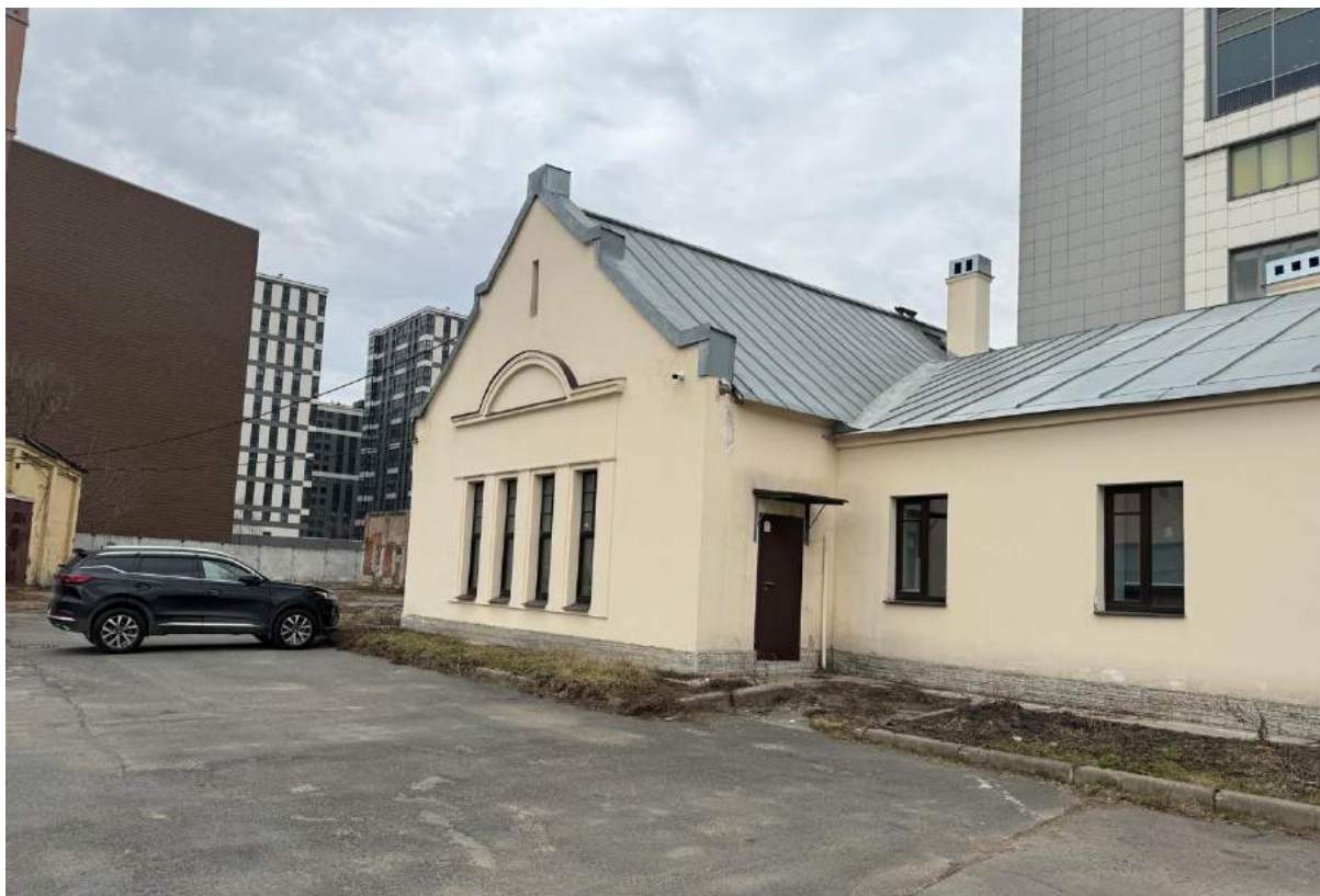
29. Фрагмент фасада объекта культурного наследия «Корпус для подопытных животных» с дворовой территории.
