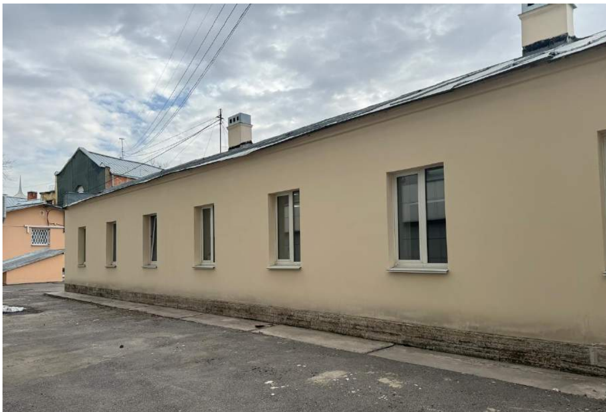
35. Фрагмент фасада объекта культурного наследия «Корпус для подопытных животных» с дворовой территории.
