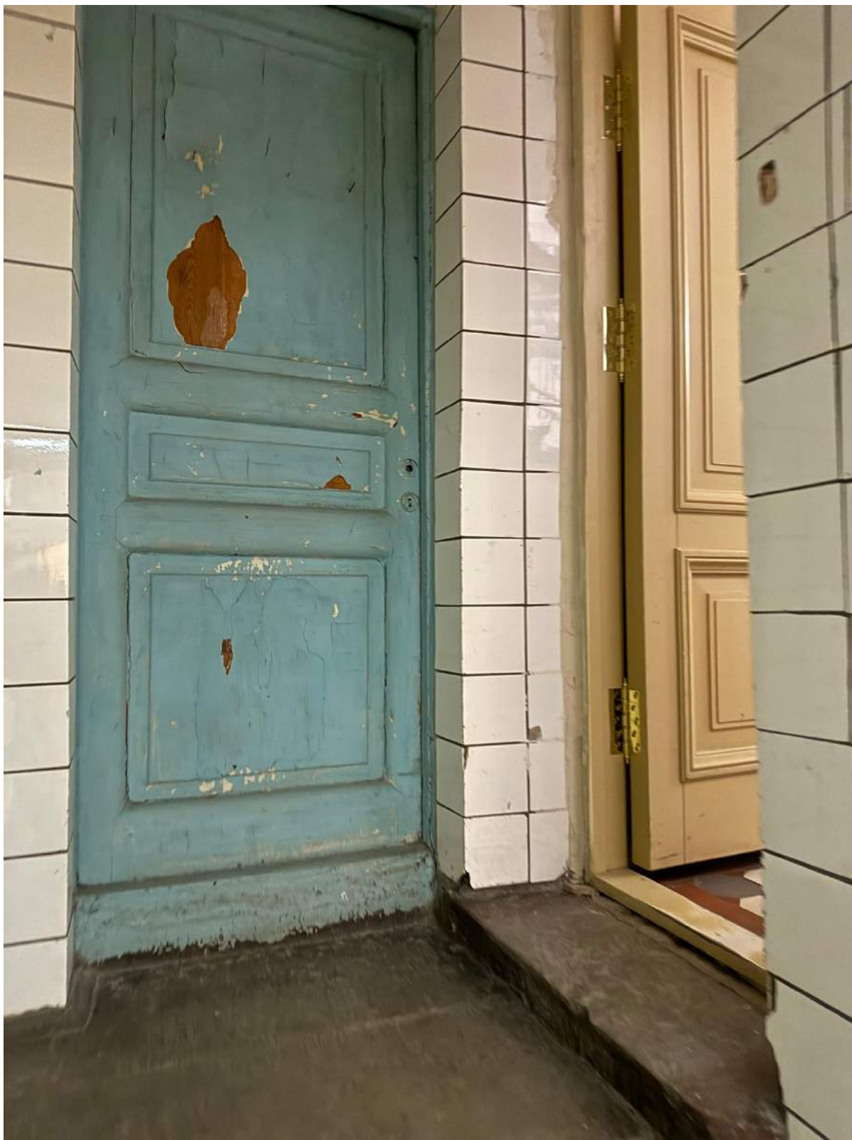
97. Вид на помещение 1-Н(60) выявленного объекта культурного наследия «Главное здание».
