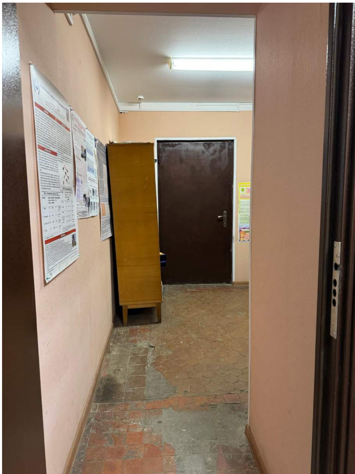
92. Вид на помещение 1-Н(74) выявленного объекта культурного наследия «Главное здание».
