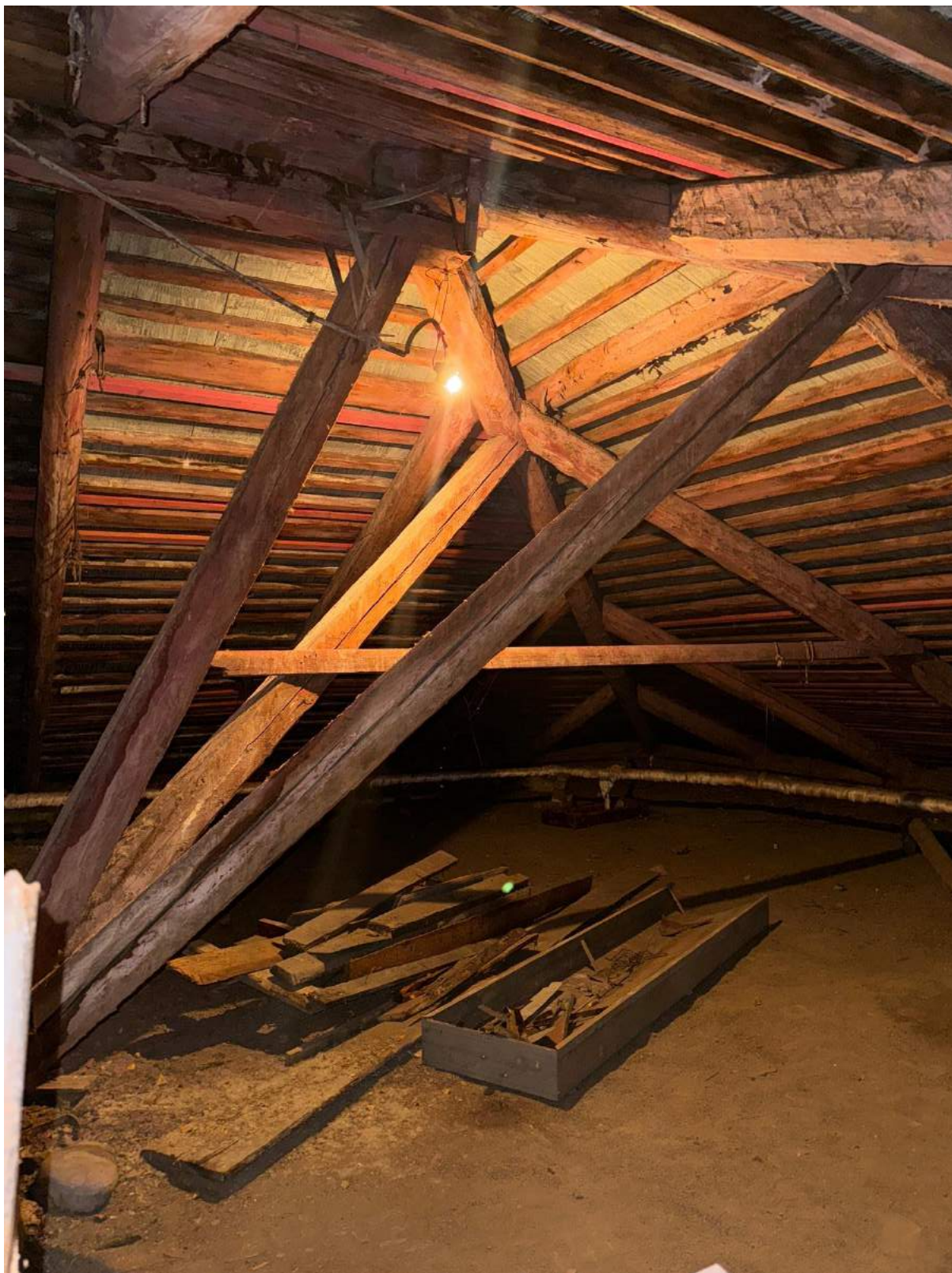
46. Фрагмент чердачного помещения выявленного объекта культурного наследия «Жилой дом».
