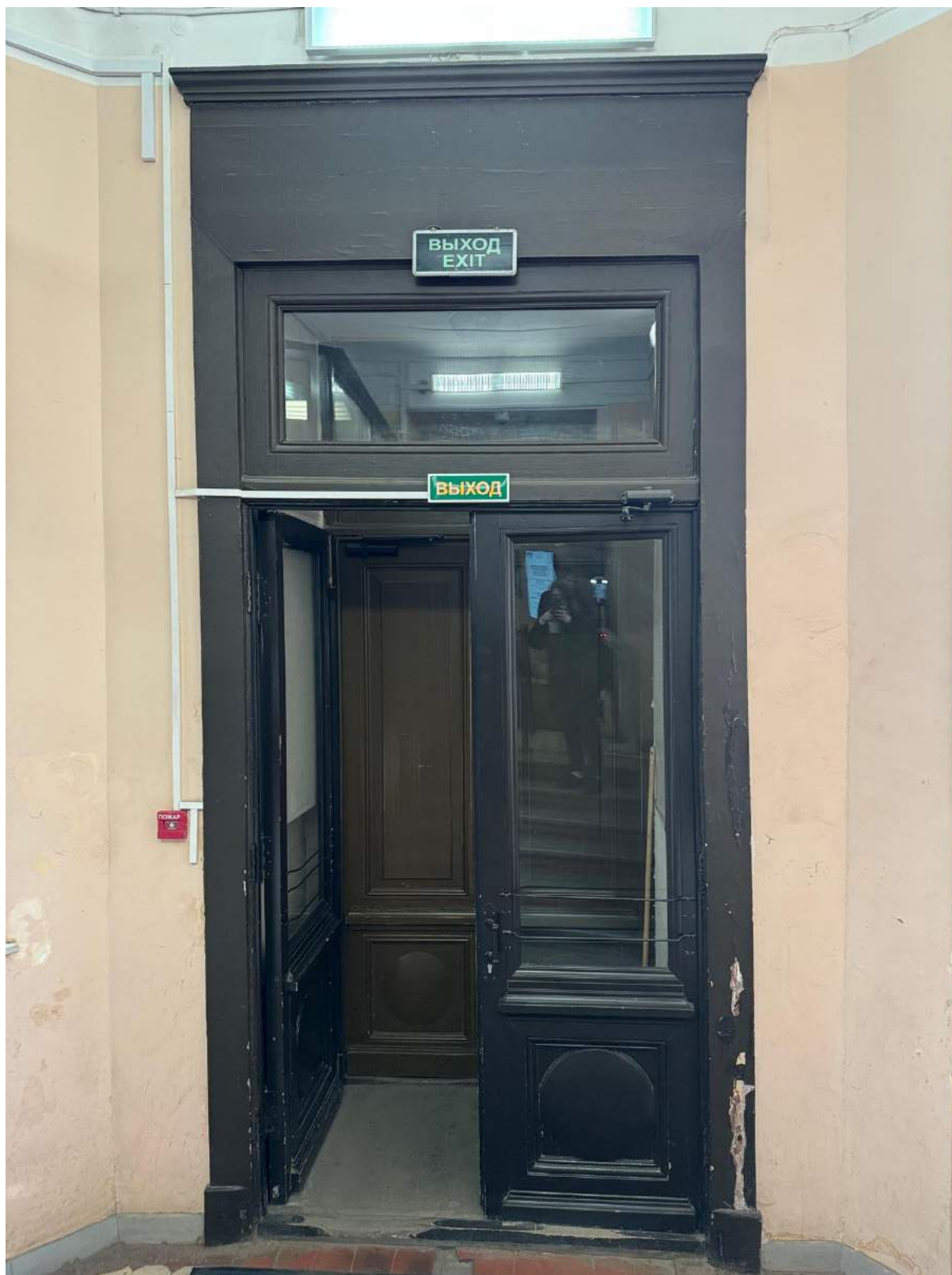
52. Дверное заполнение в части вестибюля выявленного объекта культурного наследия «Главное здание».
