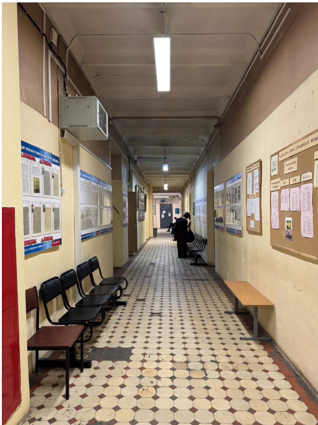
72. Вид на помещение 1-Н(33) выявленного объекта культурного наследия «Главное здание».
