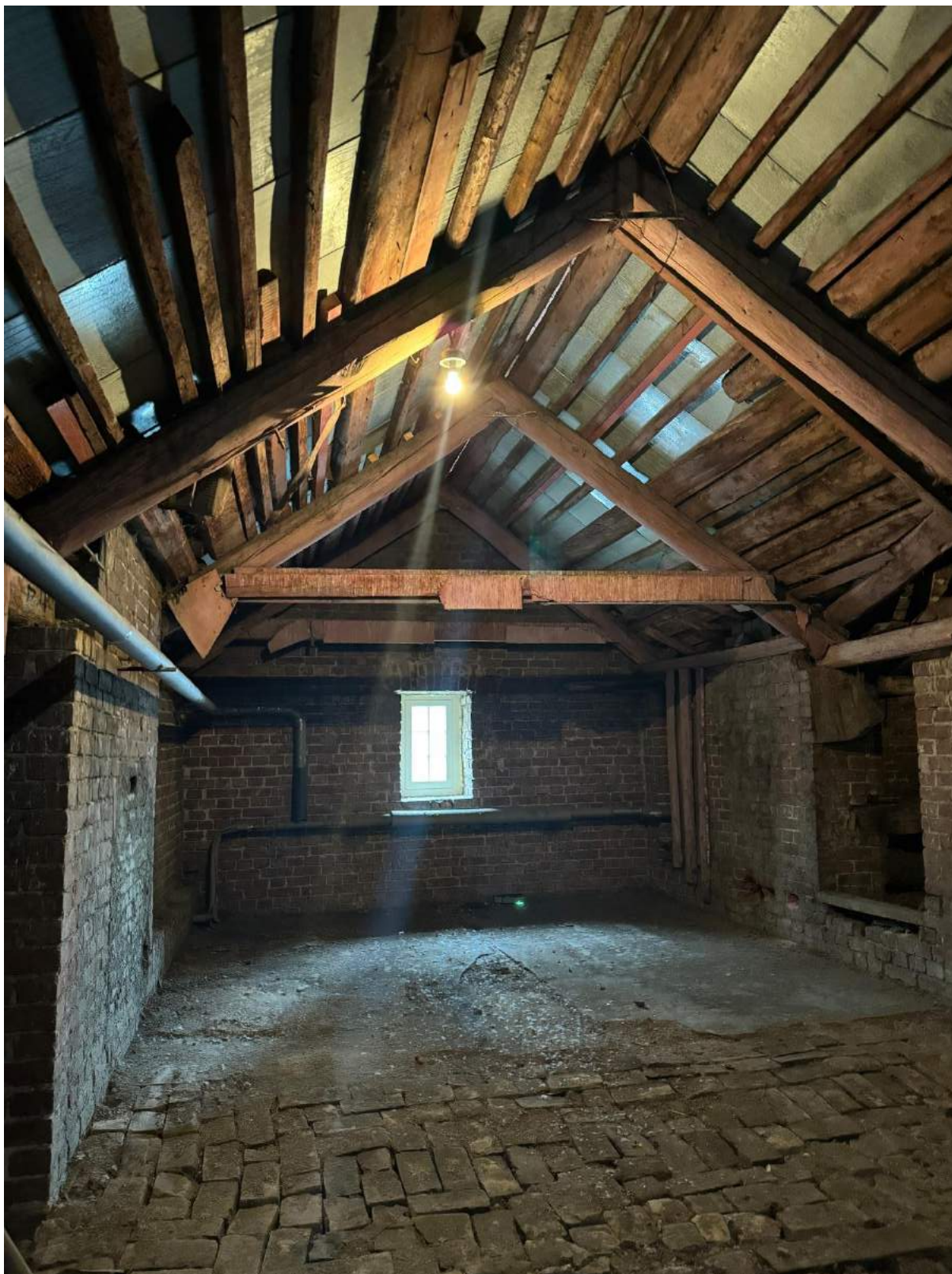
85. Вид на чердачное помещение выявленного объекта культурного наследия «Главное здание».
