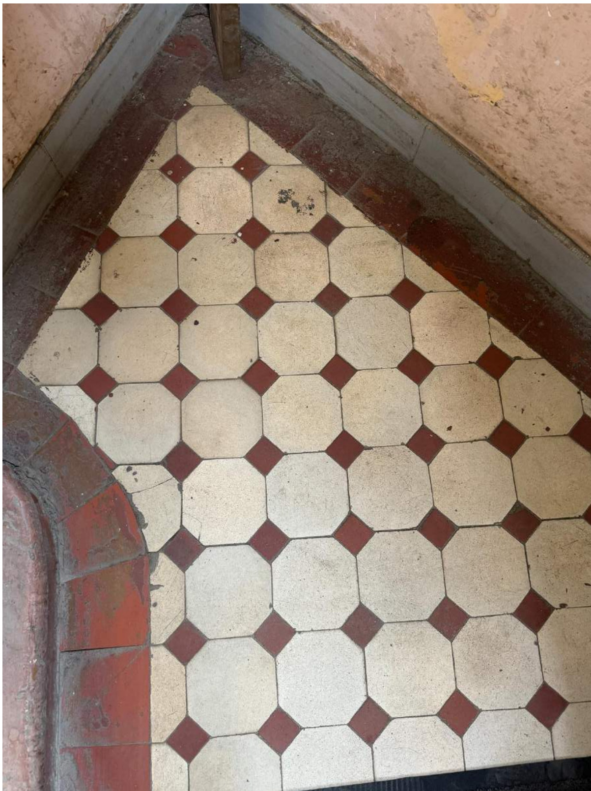
51. Покрытие пола метлахской плиткой в части вестибюля выявленного объекта культурного наследия «Главное здание».
