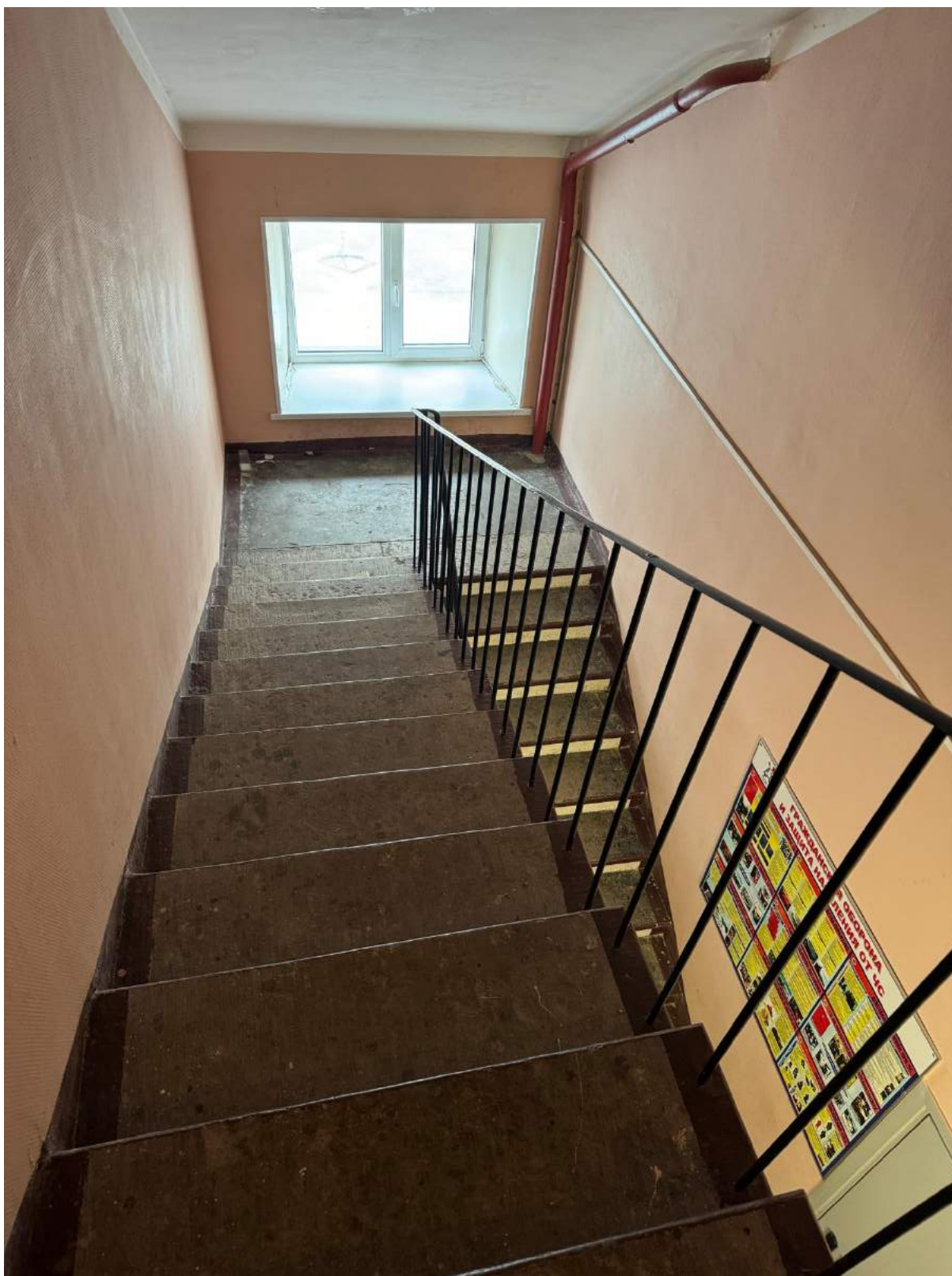
47.Общий вид лестницы 6-Н выявленного объекта культурного наследия «Жилой дом».
