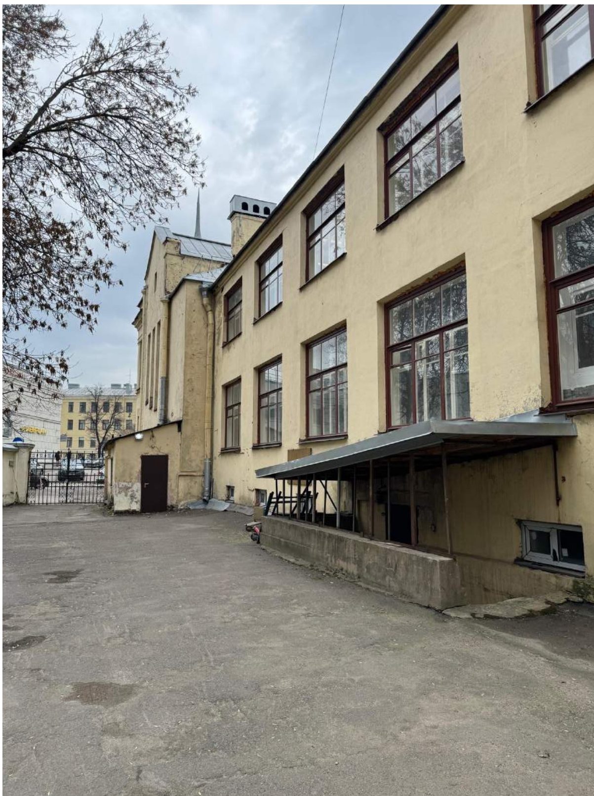
15. Фрагмент дворового фасада объекта культурного наследия «Главное здание» с дворовой территории.
