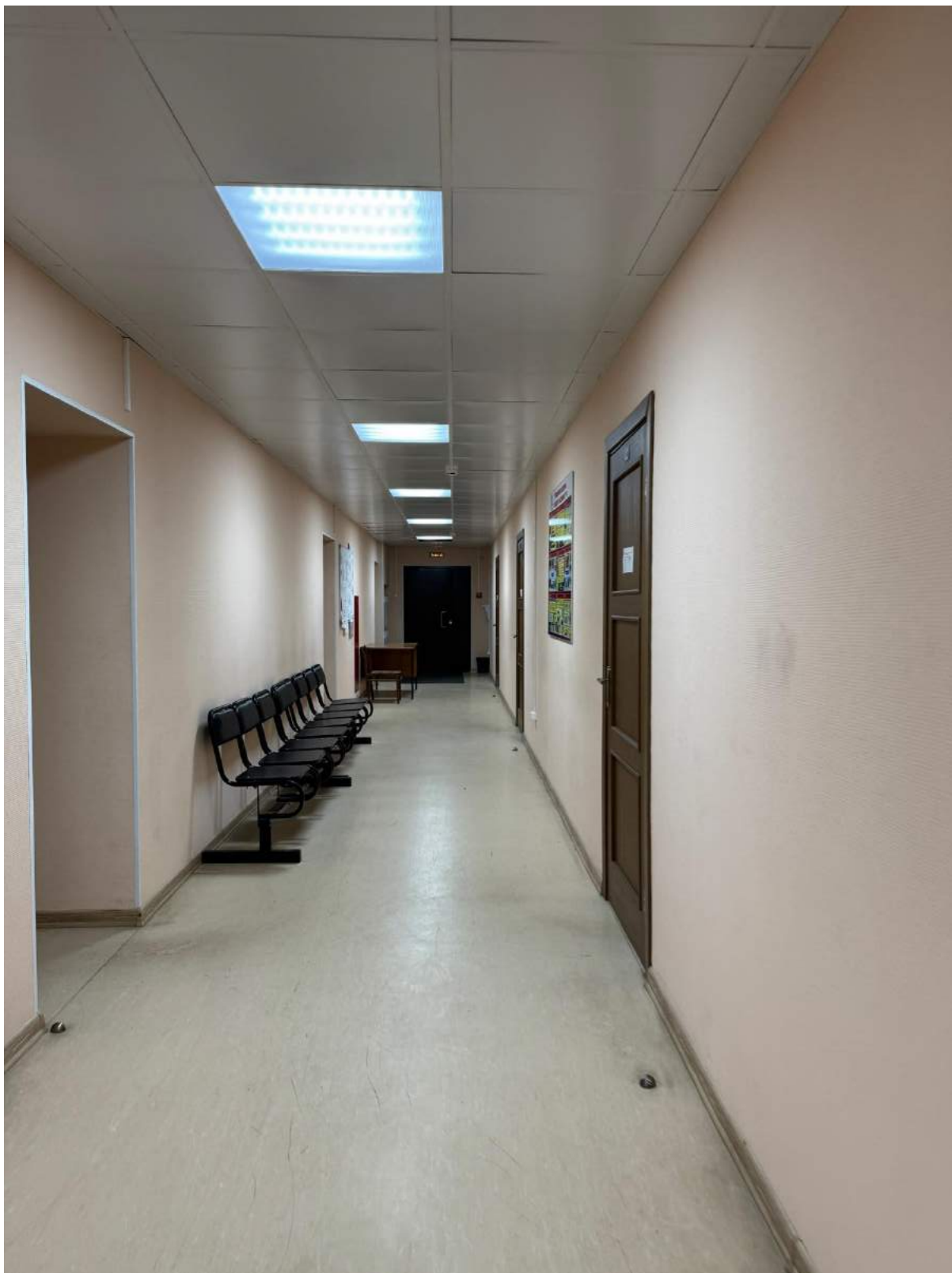
104. Вид на дверное заполнение помещения 1-Н(14) выявленного объекта культурного наследия «Корпус для подопытных животных».
