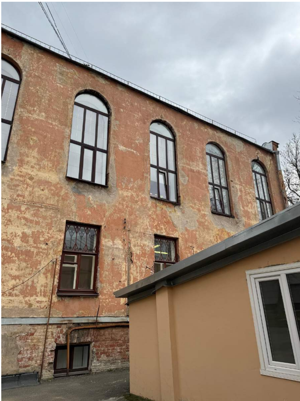
18. Фрагмент дворового фасада объекта культурного наследия «Главное здание» с дворовой территории.
