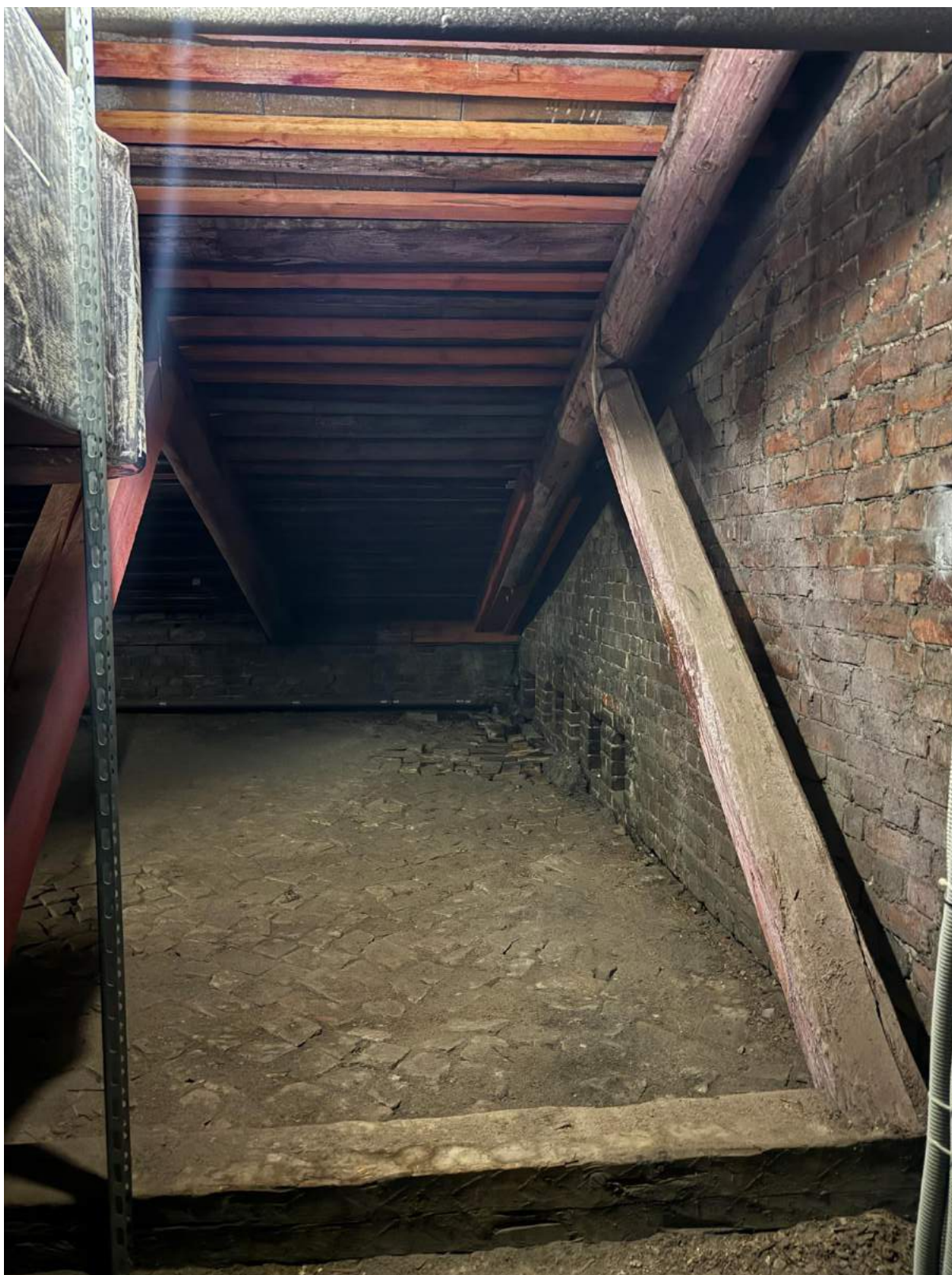
81. Вид на чердачное помещение выявленного объекта культурного наследия «Главное здание».
