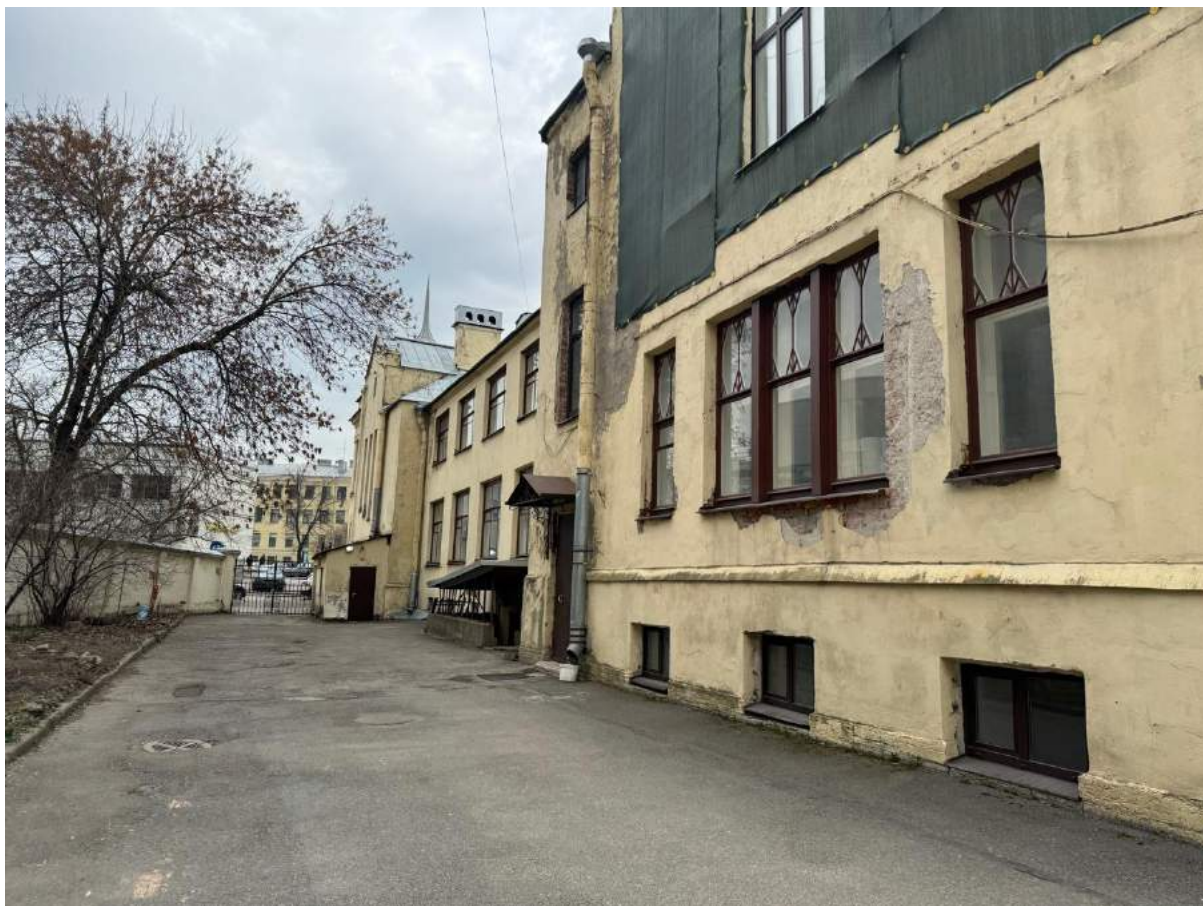
13. Фрагмент дворового фасада объекта культурного наследия «Главное здание» с дворовой территории.
