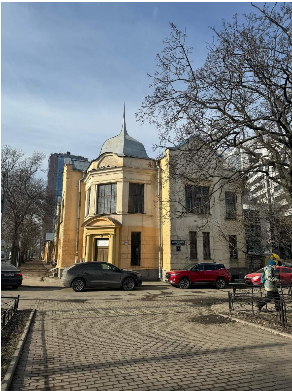
2. Общий вид лицевого фасада объекта культурного наследия «Главное здание» с Московского проспекта.
