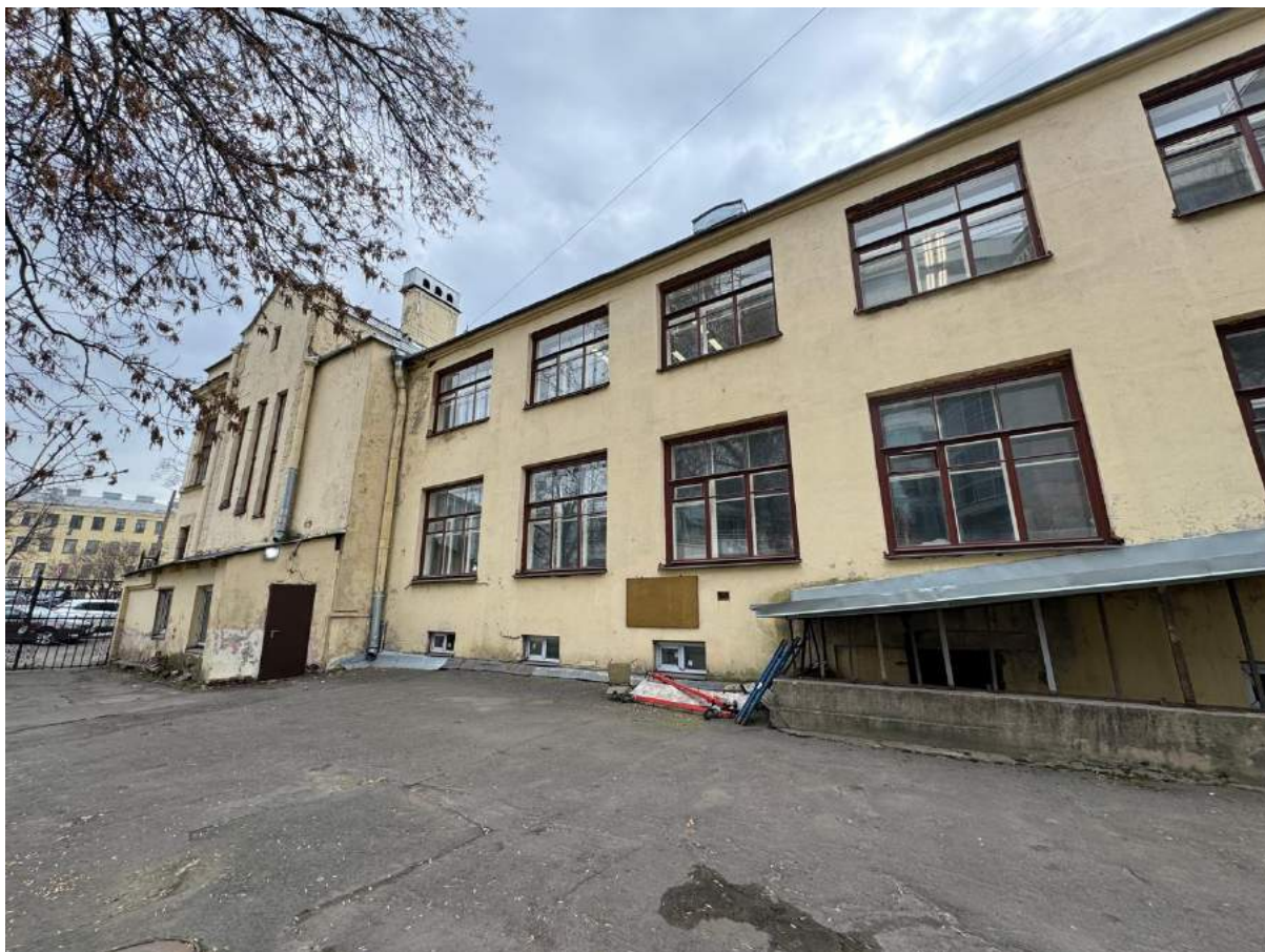
17. Фрагмент дворового фасада объекта культурного наследия «Главное здание» с дворовой территории.
