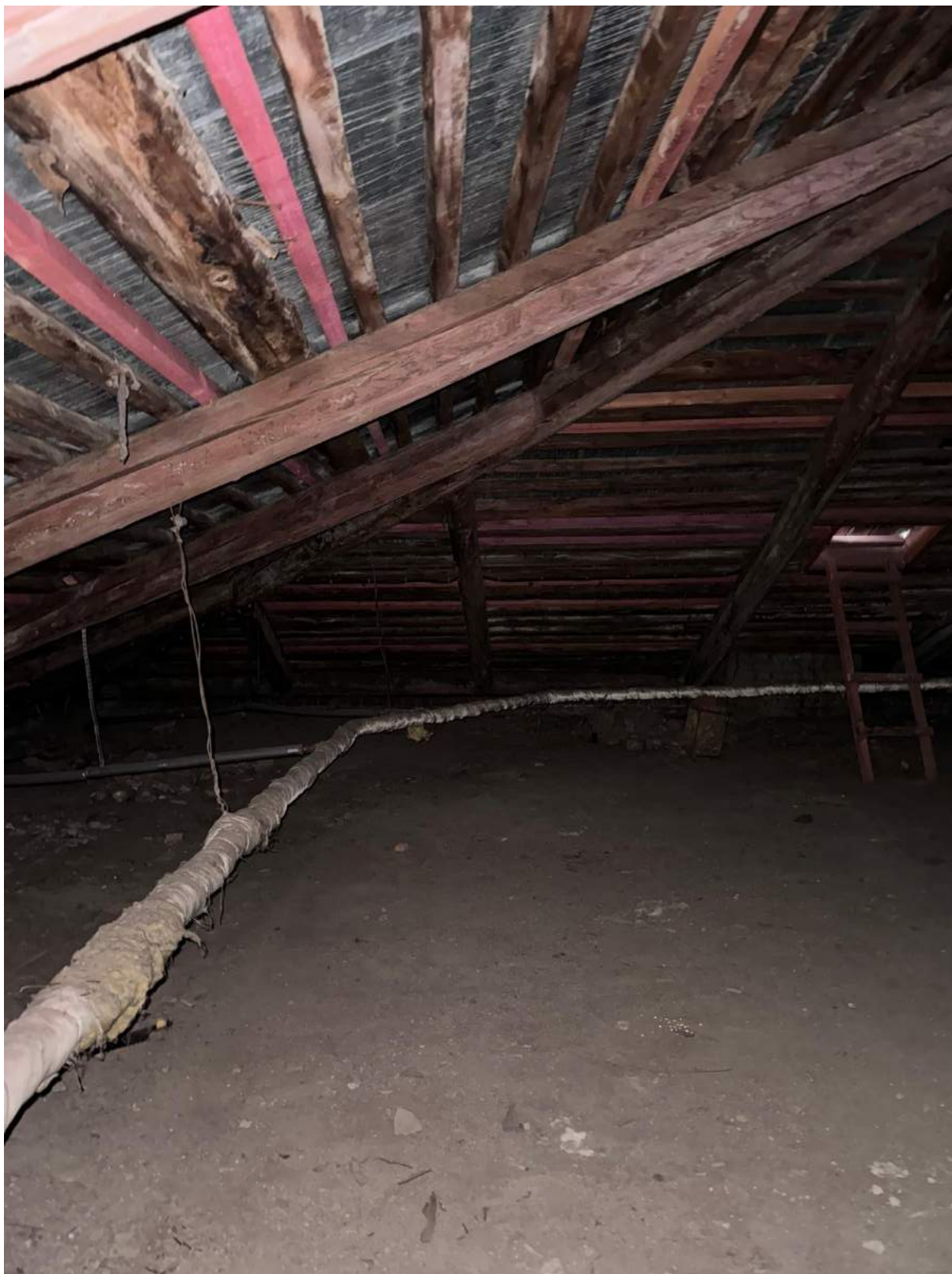
44. Фрагмент чердачного помещения выявленного объекта культурного наследия «Жилой дом».
