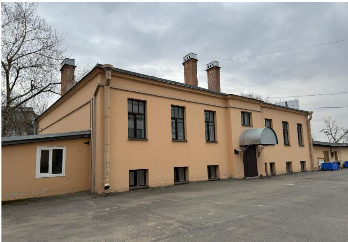
23. Фрагмент дворового фасада объекта культурного наследия «Жилой дом» с дворовой территории.
