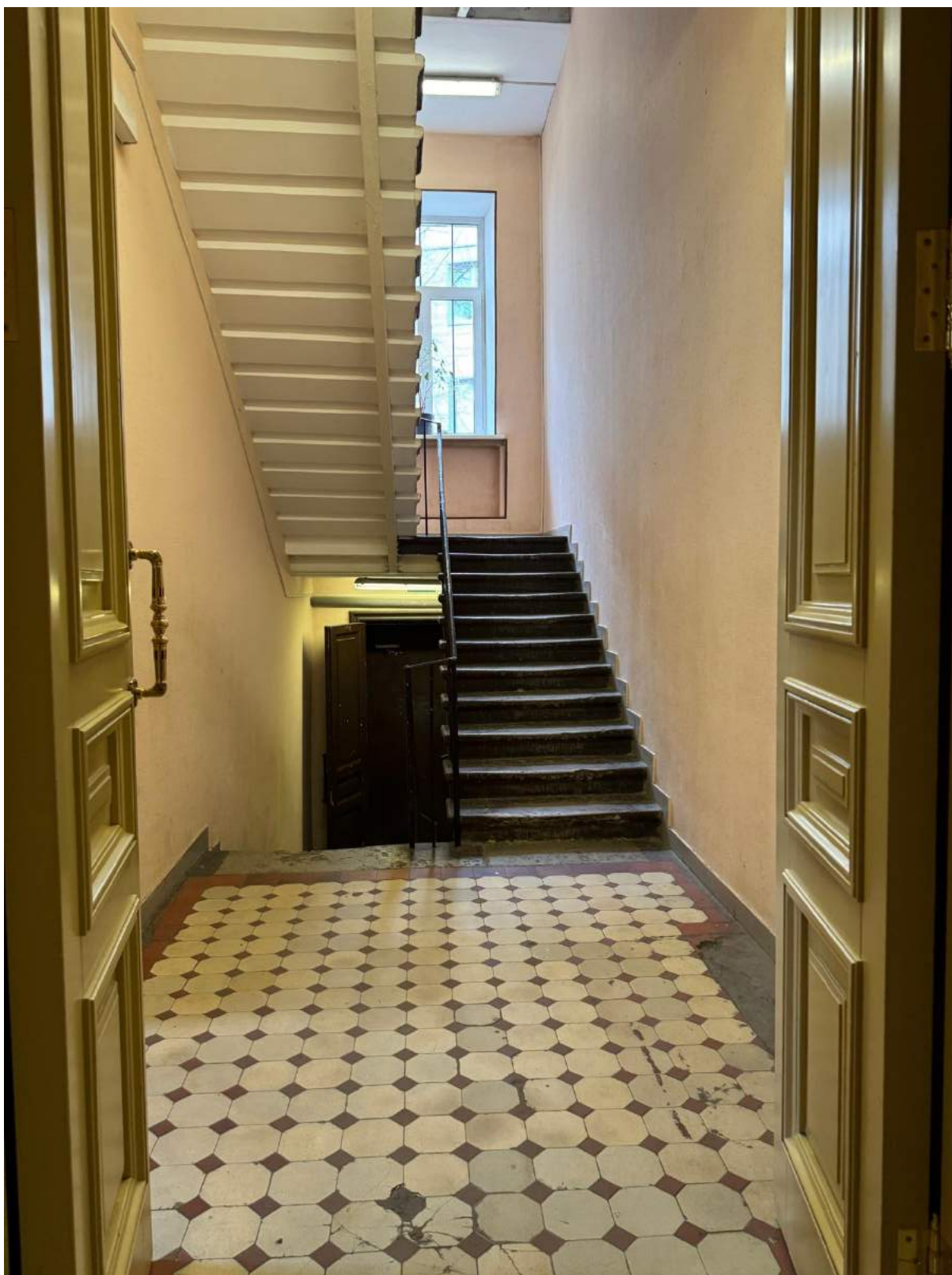
60. Общий вид лестницы 1-Н(16) выявленного объекта культурного наследия «Главное здание».
