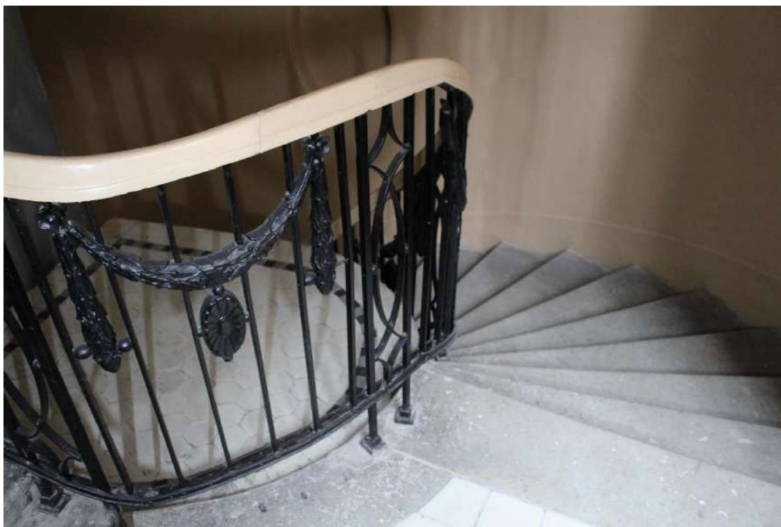
Фото 111. Выявленный объект культурного наследия «Дом Второго Санкт-Петербургского товарищества для устройства постоянных квартир (с курдонером, палисадниками и оградой)». Лестничная клетка 2ЛК в уровне 1-го - 2-го этажей.
