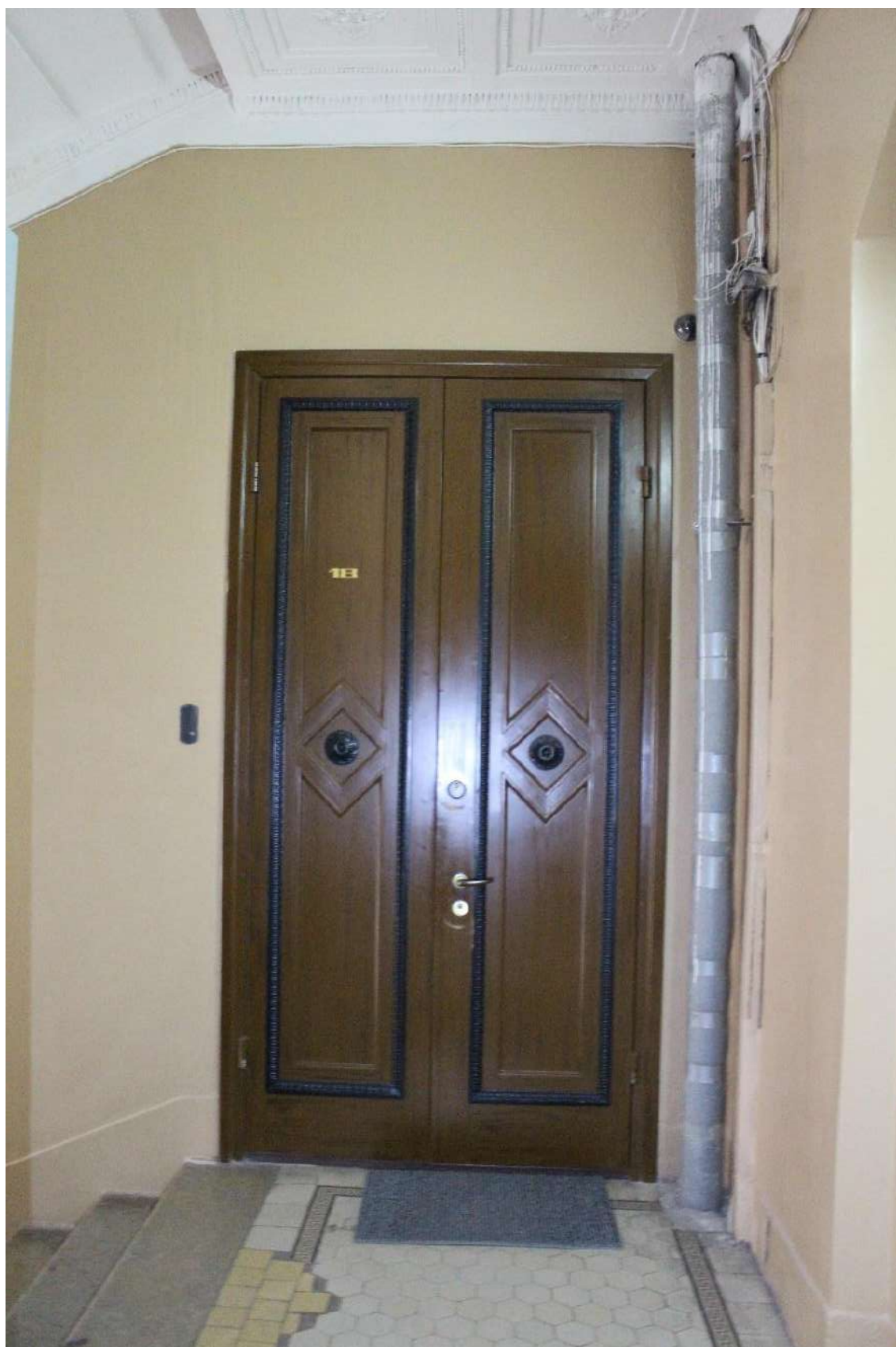
Фото 125. Выявленный объект культурного наследия «Дом Второго Санкт-Петербургского товарищества для устройства постоянных квартир (с курдонером, палисадниками и оградой)». Лестничная клетка 2ЛК в уровне 4-го этажа.
