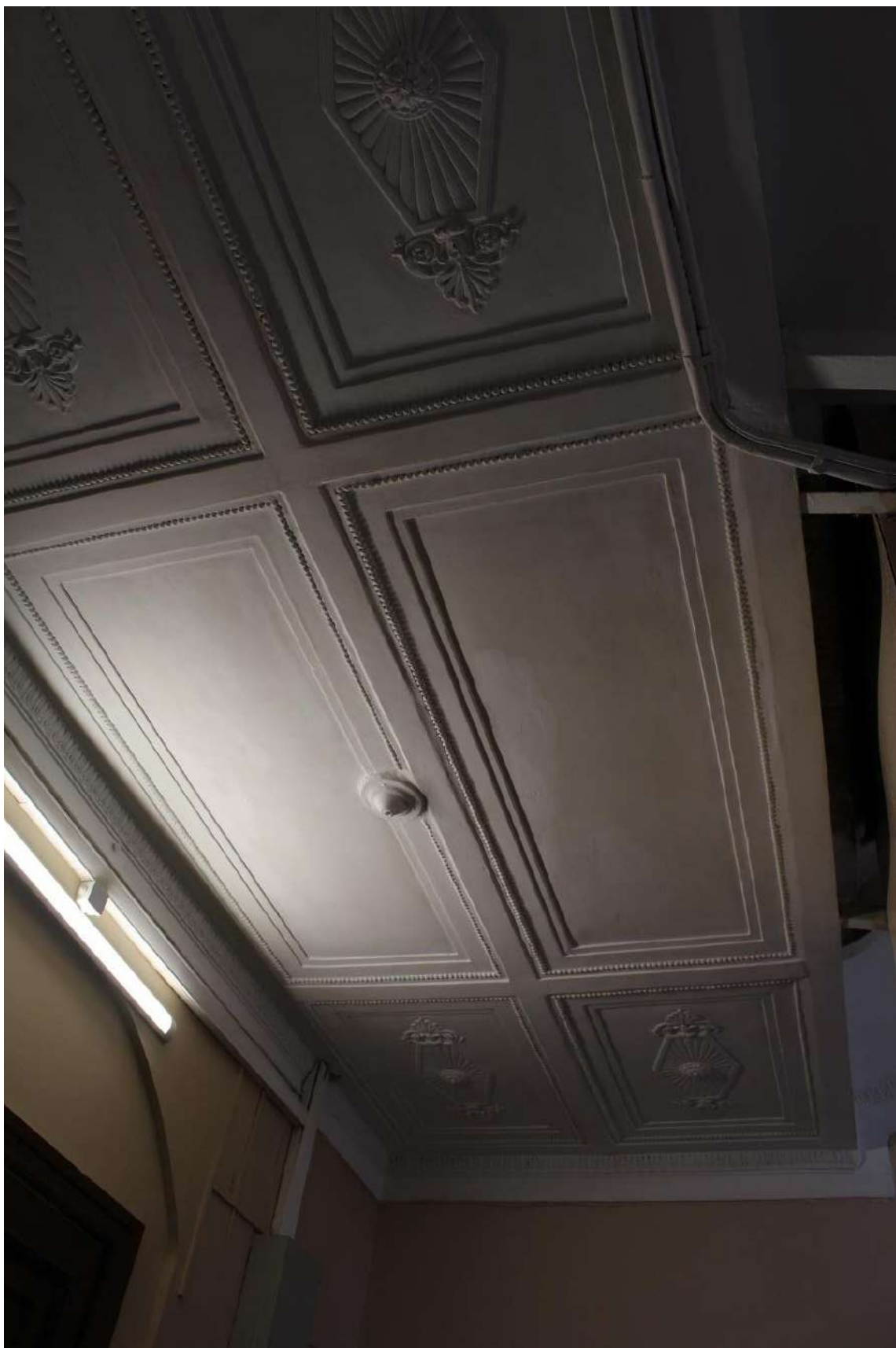
Фото 74. Выявленный объект культурного наследия «Дом Второго Санкт-Петербургского товарищества для устройства постоянных квартир (с курдонером, палисадниками и оградой)». Лестничная клетка 1ЛК в уровне 2-го этажа.
