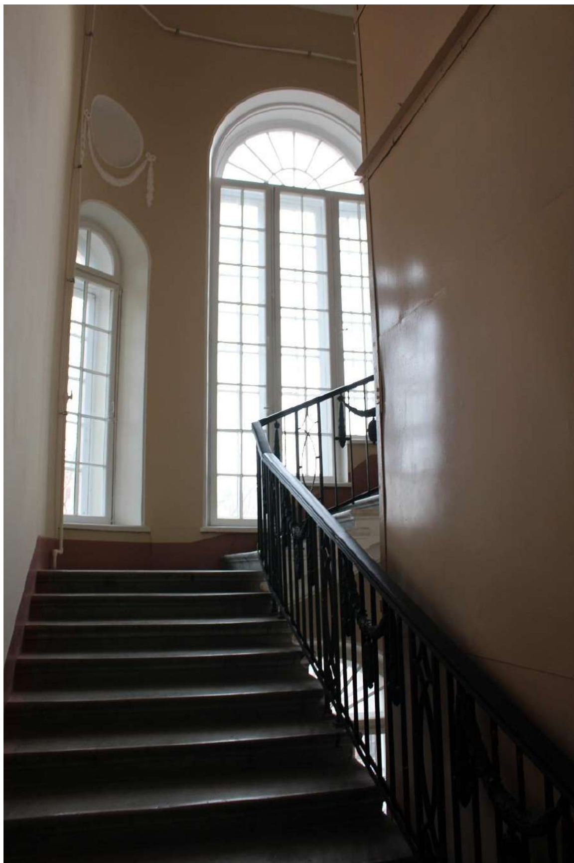
Фото 87. Выявленный объект культурного наследия «Дом Второго Санкт-Петербургского товарищества для устройства постоянных квартир (с курдонером, палисадниками и оградой)». Лестничная клетка 1ЛК в уровне 4-го – 5-го этажей.
