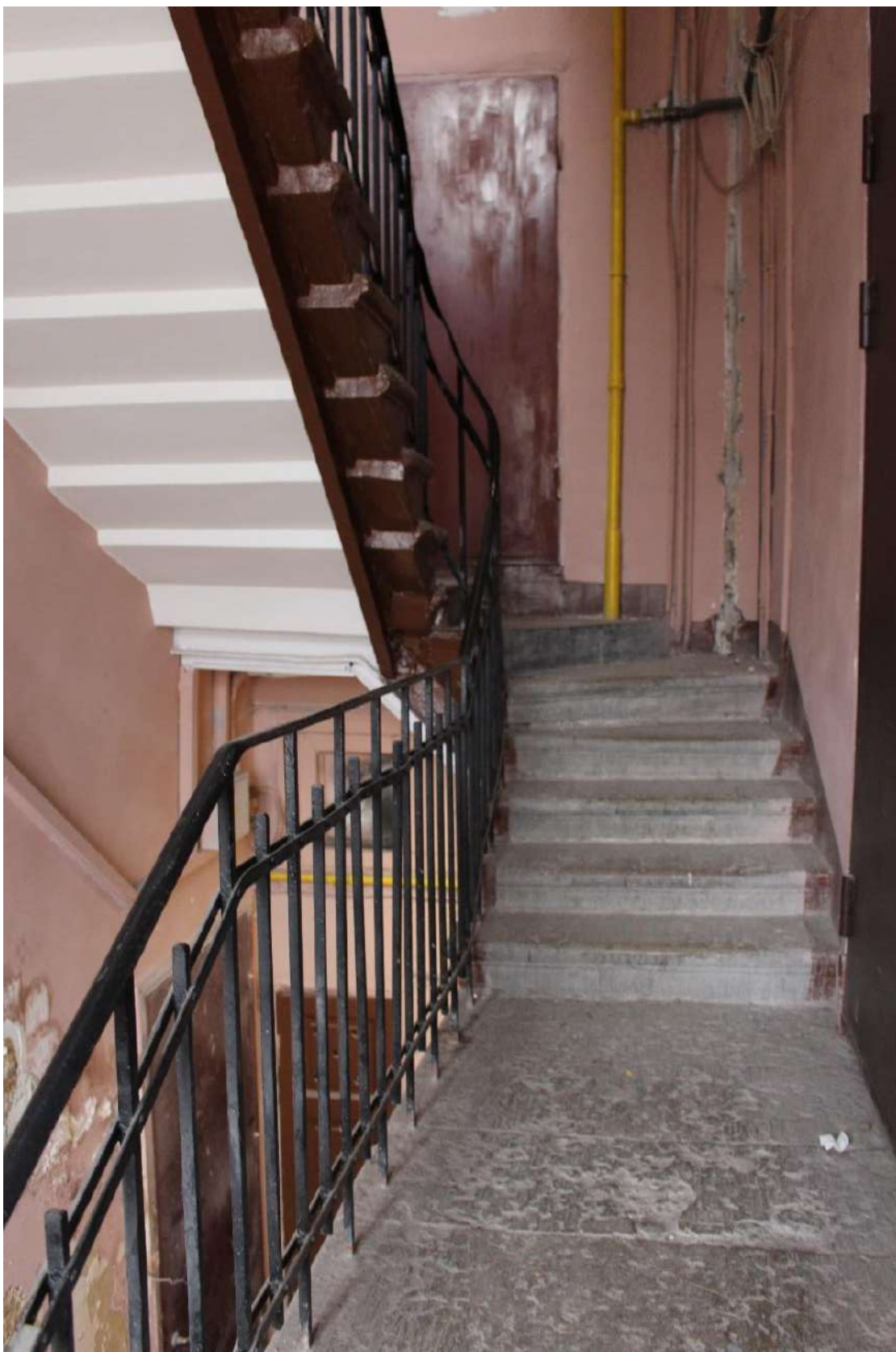
Фото 233. Выявленный объект культурного наследия «Дом Второго Санкт-Петербургского товарищества для устройства постоянных квартир (с курдонером, палисадниками и оградой)». Лестничная клетка 11ЛК в уровне 4-го этажа.
