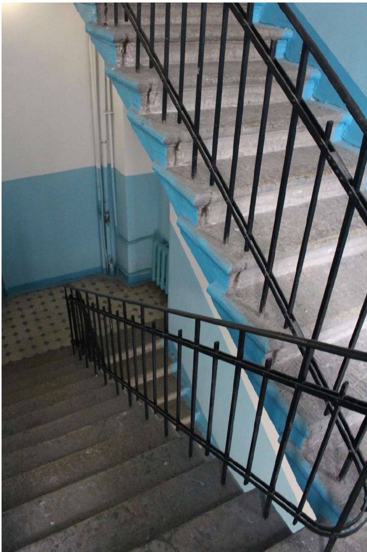
Фото 140. Выявленный объект культурного наследия «Дом Второго Санкт-Петербургского товарищества для устройства постоянных квартир (с курдонером, палисадниками и оградой)». Лестничная клетка ЗЛК в уровне 3-го – 4-го этажей.
