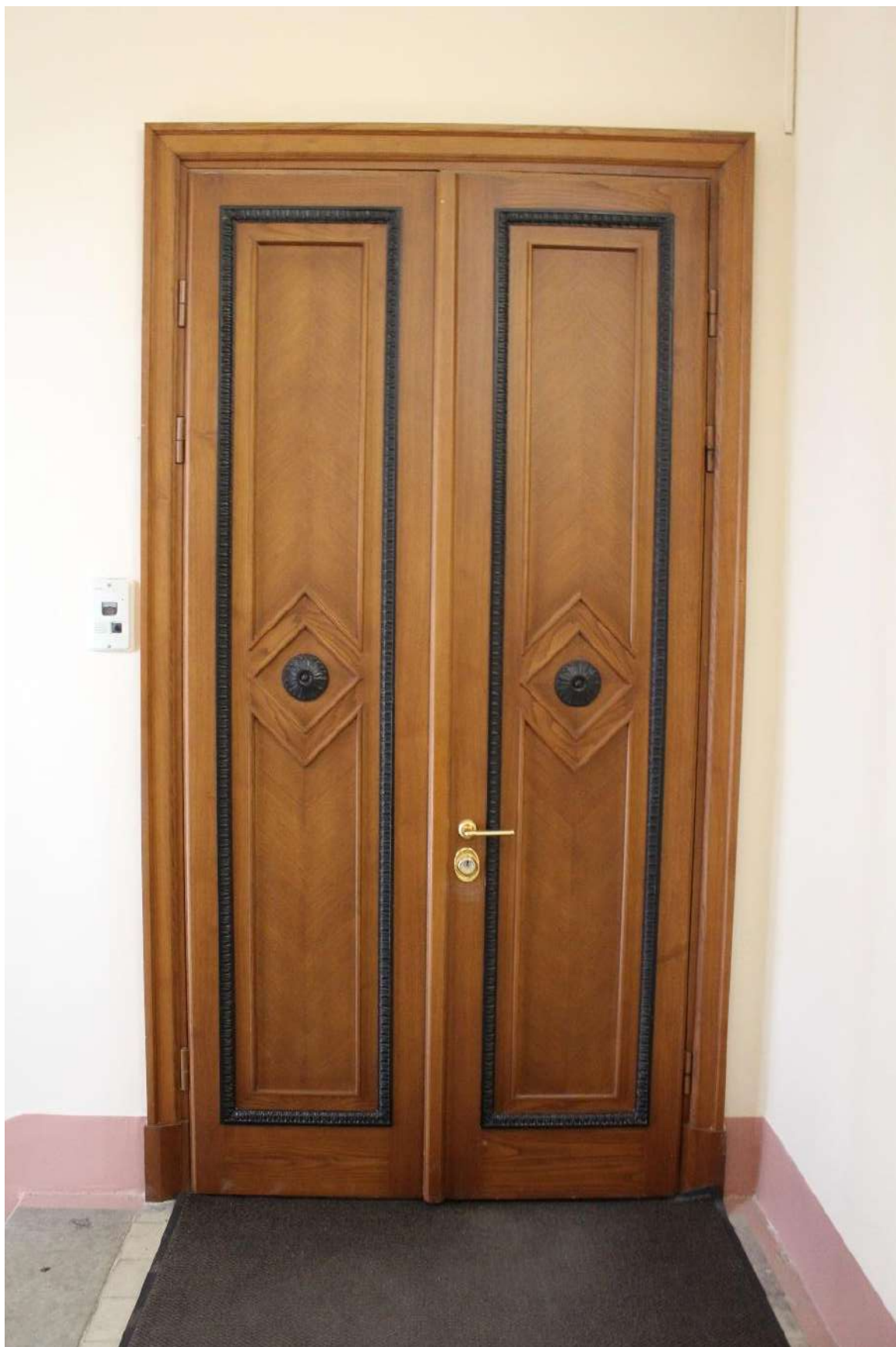
Фото 85. Выявленный объект культурного наследия «Дом Второго Санкт-Петербургского товарищества для устройства постоянных квартир (с курдонером, палисадниками и оградой)». Лестничная клетка 1ЛК в уровне 4-го этажа.
