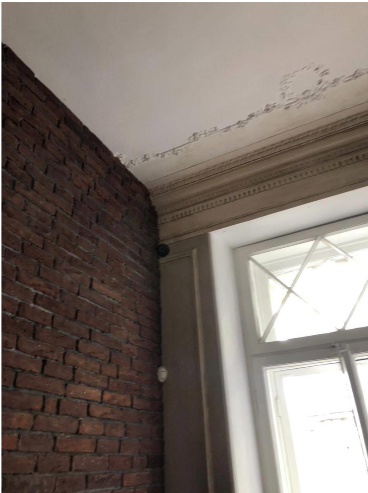
Илл. 65. Помещение 10-Н. Вид на ч.п. 6 пл. 26,7 кв. м. 31.08.2021 г. (предоставлено собственником помещения 10-Н).
