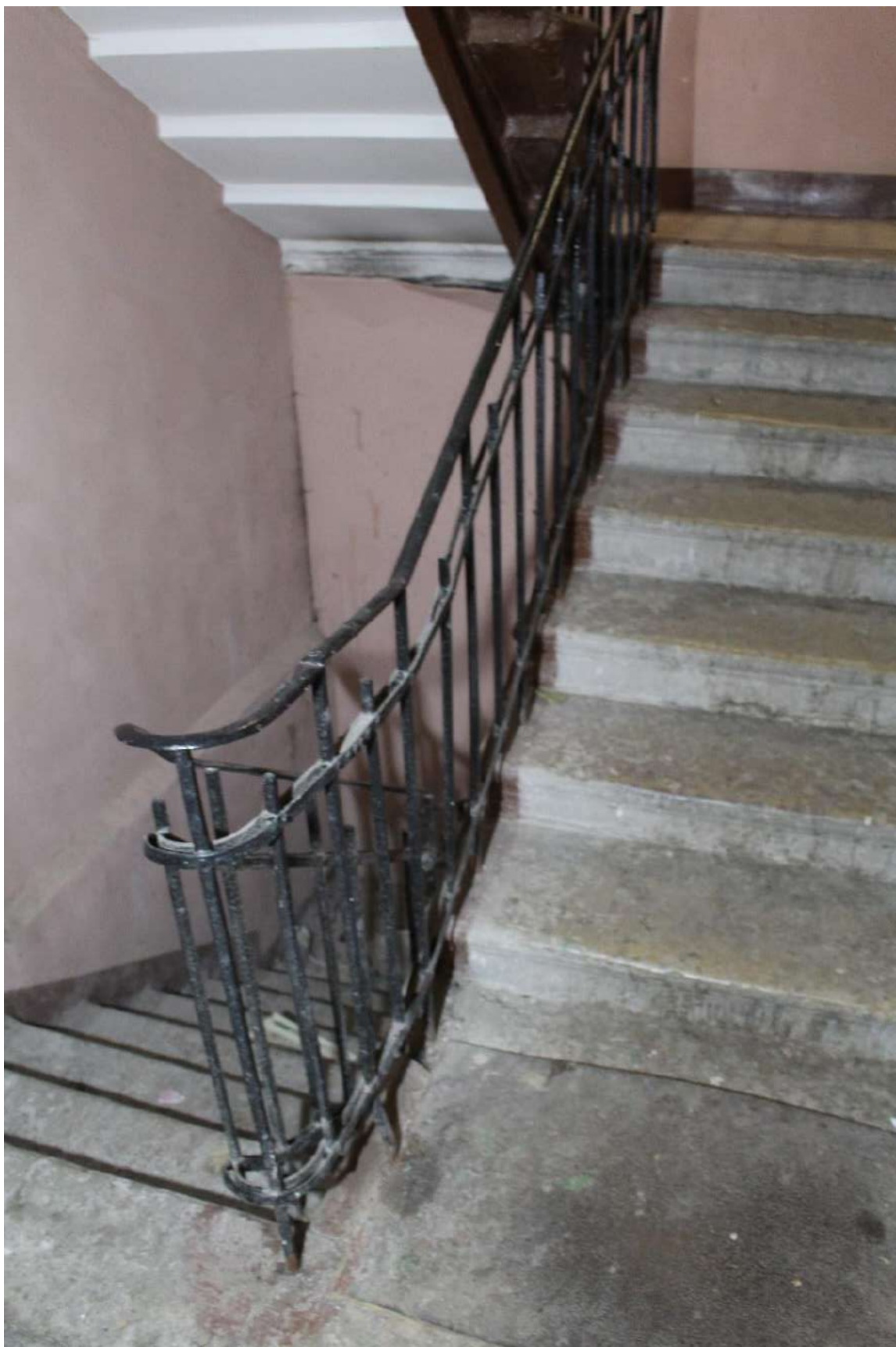
Фото 226. Выявленный объект культурного наследия «Дом Второго Санкт-Петербургского товарищества для устройства постоянных квартир (с курдонером, палисадниками и оградой)». Лестничная клетка 11ЛК в уровне 1-го этажа.
