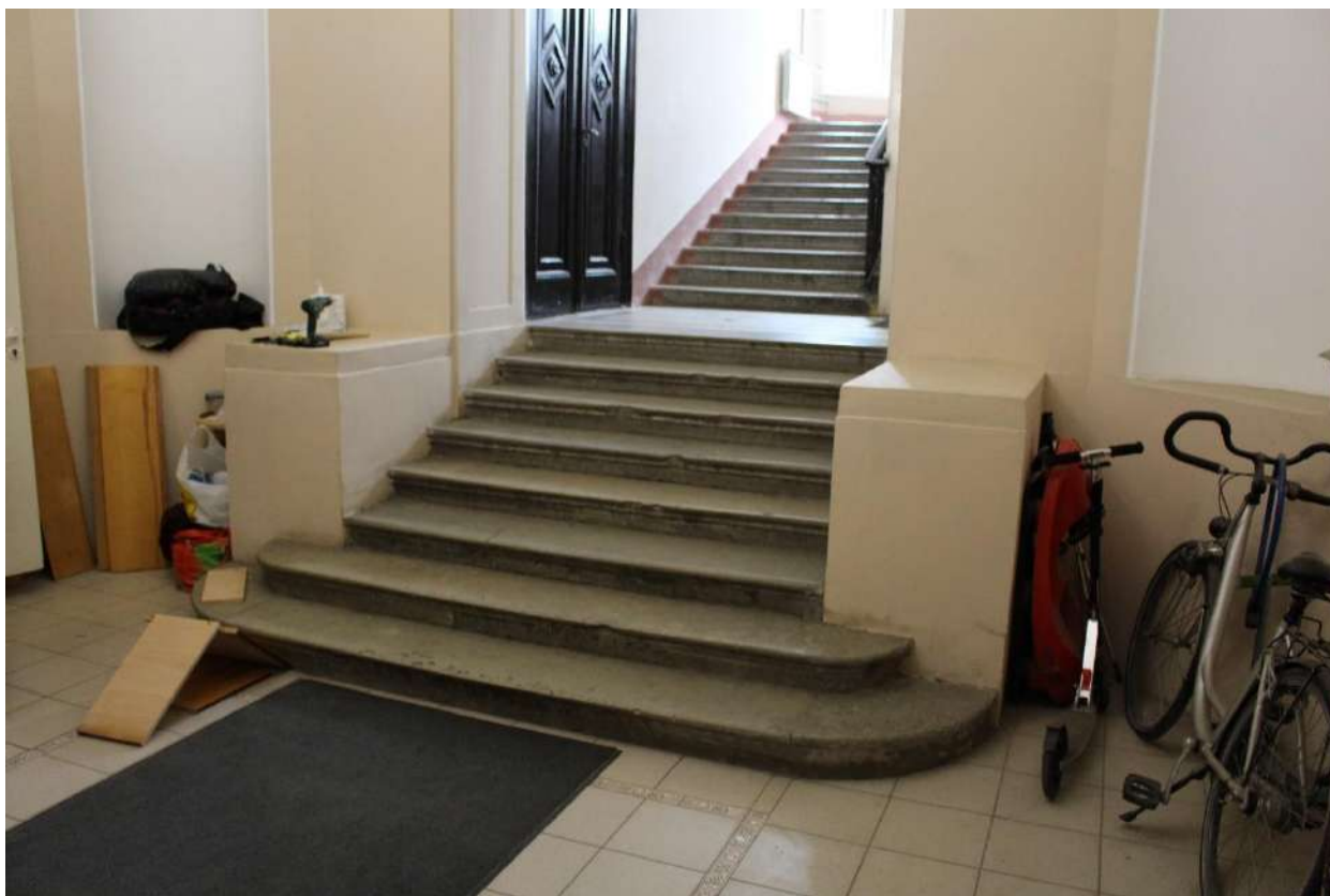
Фото 62. Выявленный объект культурного наследия «Дом Второго Санкт-Петербургского товарищества для устройства постоянных квартир (с курдонером, палисадниками и оградой)». Вестибюль лестничной клетки 1ЛК.
