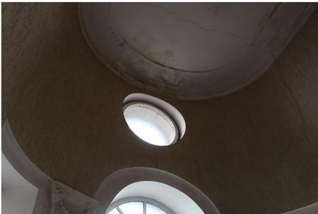
Фото 218. Выявленный объект культурного наследия «Дом Второго Санкт-Петербургского товарищества для устройства постоянных квартир (с курдонером, палисадниками и оградой)». Лестничная клетка 9ЛК в уровне мансардного этажа.
