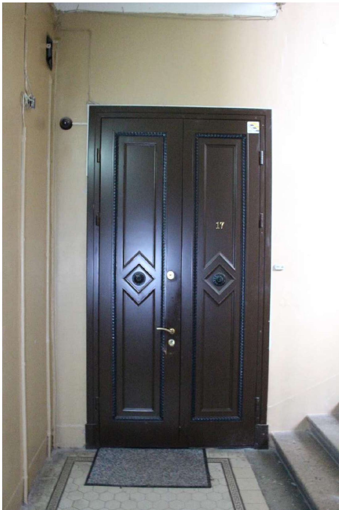
Фото 124. Выявленный объект культурного наследия «Дом Второго Санкт-Петербургского товарищества для устройства постоянных квартир (с курдонером, палисадниками и оградой)». Лестничная клетка 2ЛК в уровне 4-го этажа.
