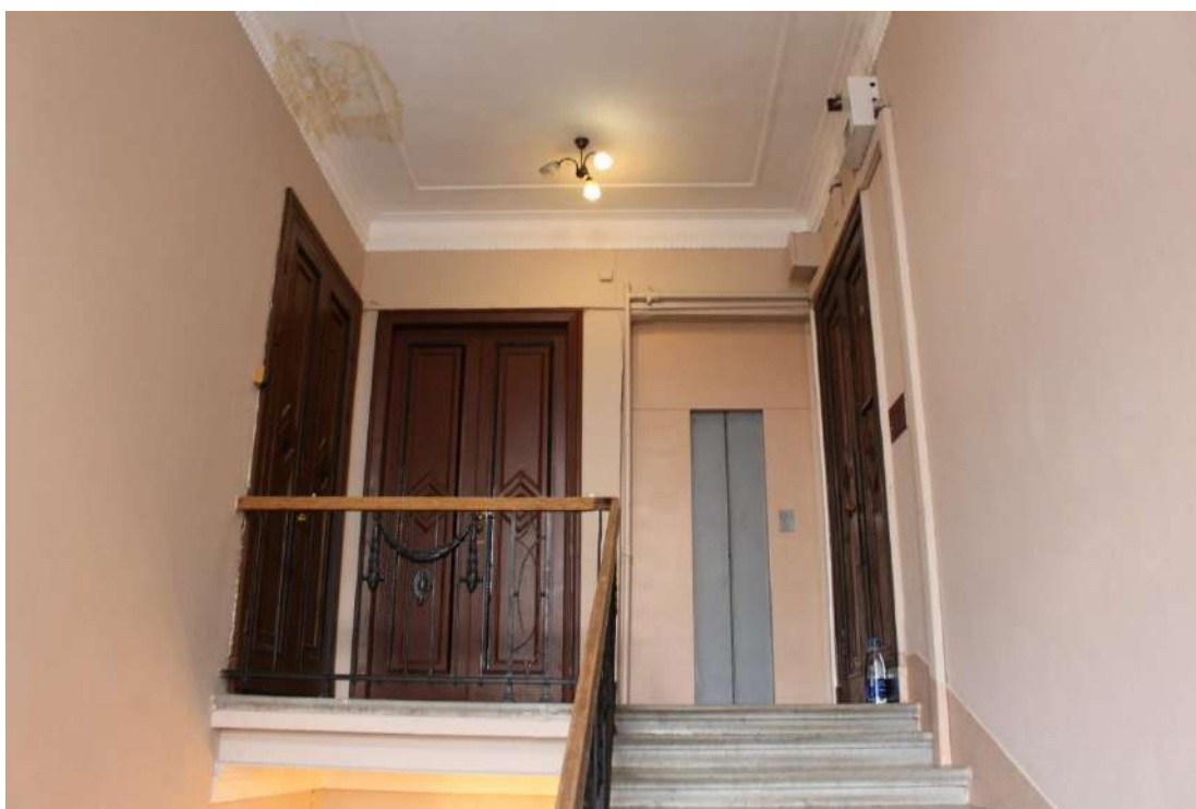
Фото 191. Выявленный объект культурного наследия «Дом Второго Санкт-Петербургского товарищества для устройства постоянных квартир (с курдонером, палисадниками и оградой)». Лестничная клетка 7ЛК в уровне 6-го этажа.
