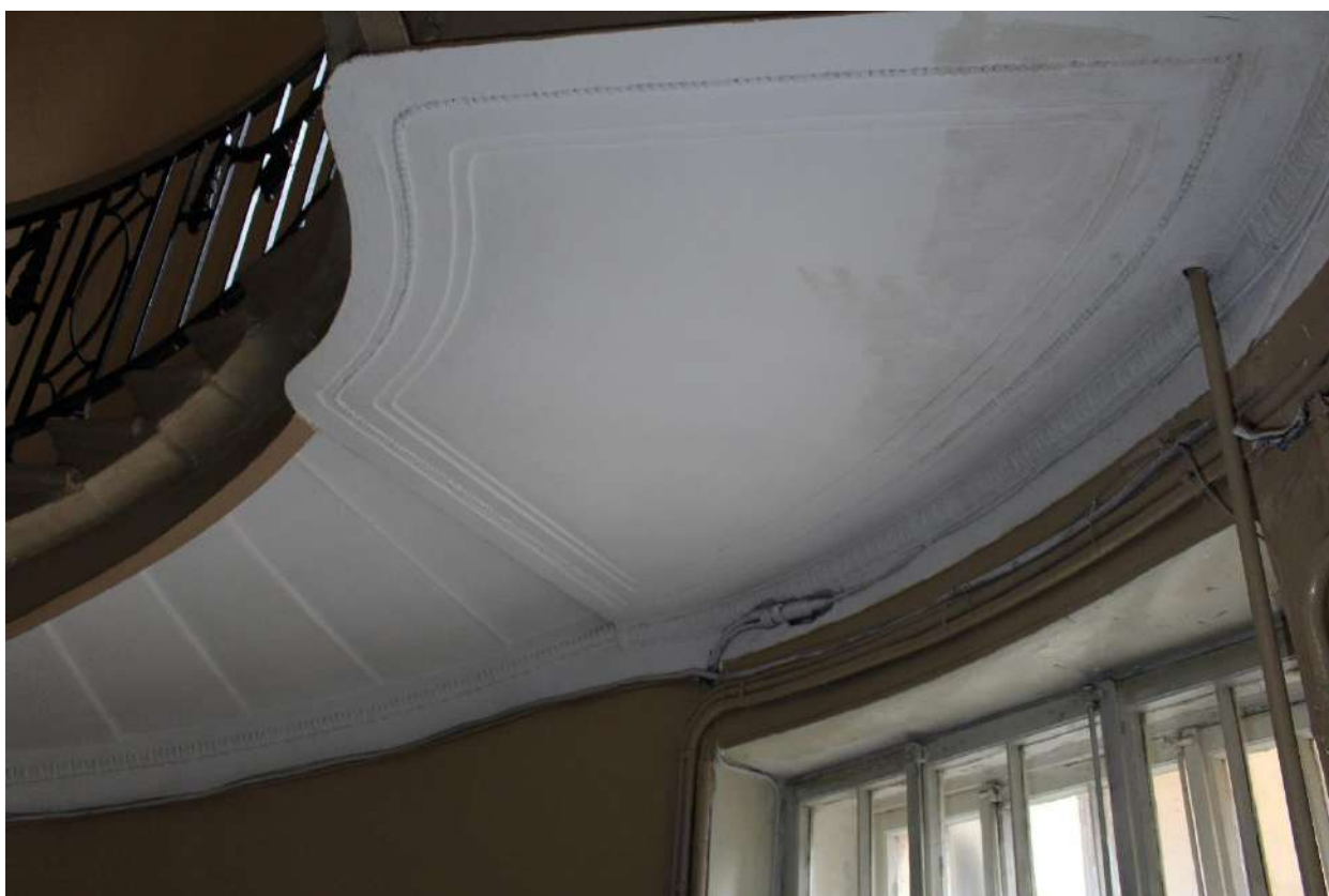
Фото 112. Выявленный объект культурного наследия «Дом Второго Санкт-Петербургского товарищества для устройства постоянных квартир (с курдонером, палисадниками и оградой)». Лестничная клетка 2ЛК в уровне 1-го - 2-го этажей.
