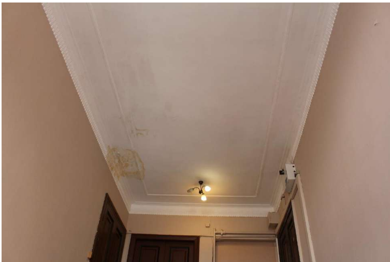
Фото 192. Выявленный объект культурного наследия «Дом Второго Санкт-Петербургского товарищества для устройства постоянных квартир (с курдонером, палисадниками и оградой)». Лестничная клетка 7ЛК в уровне 6-го этажа.
