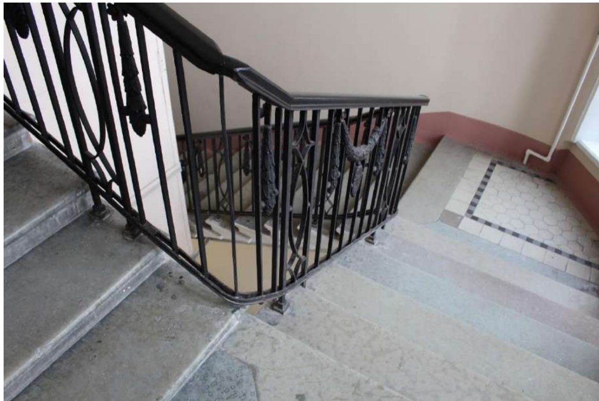
Фото 89. Выявленный объект культурного наследия «Дом Второго Санкт-Петербургского товарищества для устройства постоянных квартир (с курдонером, палисадниками и оградой)». Лестничная клетка 1ЛК в уровне 4-го – 5-го этажей.
