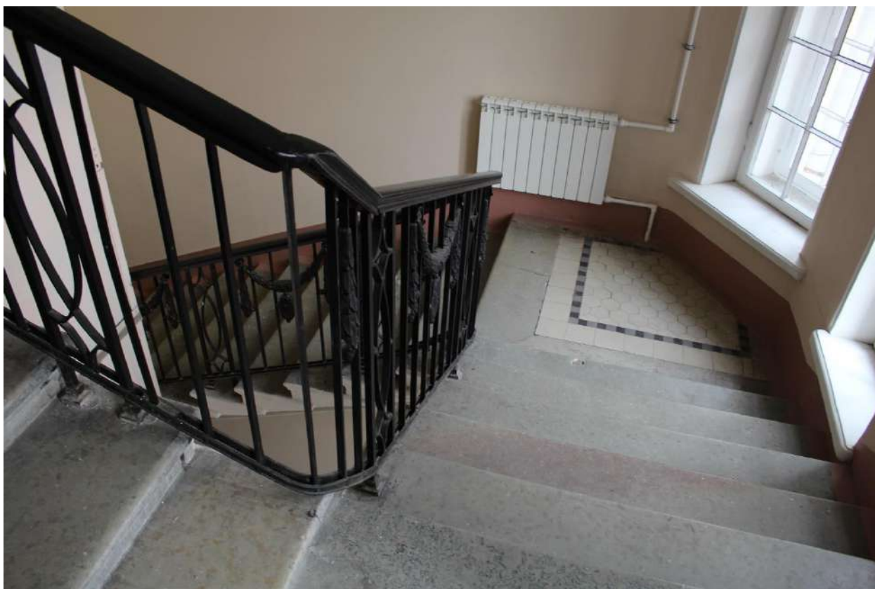
Фото 78. Выявленный объект культурного наследия «Дом Второго Санкт-Петербургского товарищества для устройства постоянных квартир (с курдонером, палисадниками и оградой)». Лестничная клетка 1ЛК в уровне 2-го - 3-го этажей.
