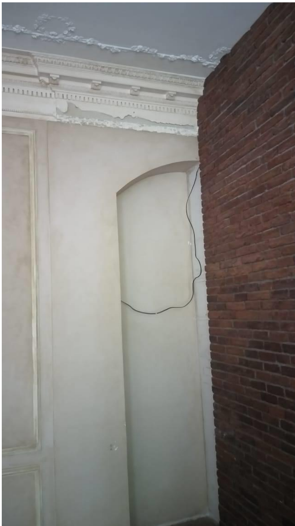
Илл. 64. Помещение 10-Н. Вид на ч.п. 6 пл. 26,7 кв. м. 31.08.2021 г. (предоставлено собственником помещения 10-Н).
