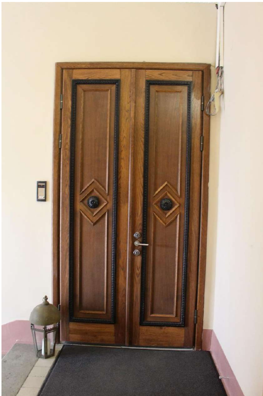
Фото 92. Выявленный объект культурного наследия «Дом Второго Санкт-Петербургского товарищества для устройства постоянных квартир (с курдонером, палисадниками и оградой)». Лестничная клетка 1ЛК в уровне 5-го этажа.
