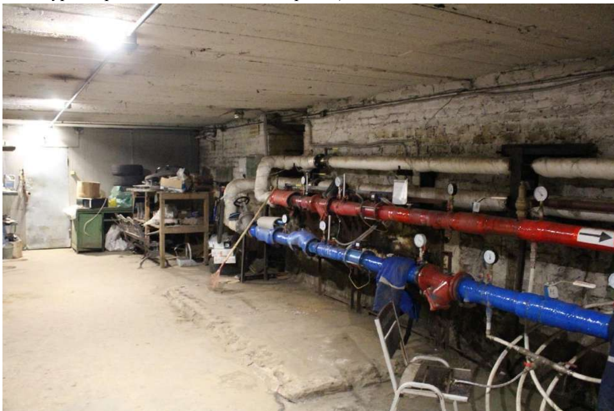
Фото 239. Выявленный объект культурного наследия «Дом Второго Санкт-Петербургского товарищества для устройства постоянных квартир (с курдонером, палисадниками и оградой)». Подвальное помещение 2-Н.
