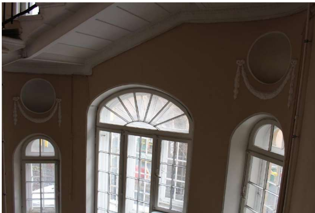
Фото 72. Выявленный объект культурного наследия «Дом Второго Санкт-Петербургского товарищества для устройства постоянных квартир (с курдонером, палисадниками и оградой)». Лестничная клетка 1ЛК в уровне 1-го - 2-го этажей.
