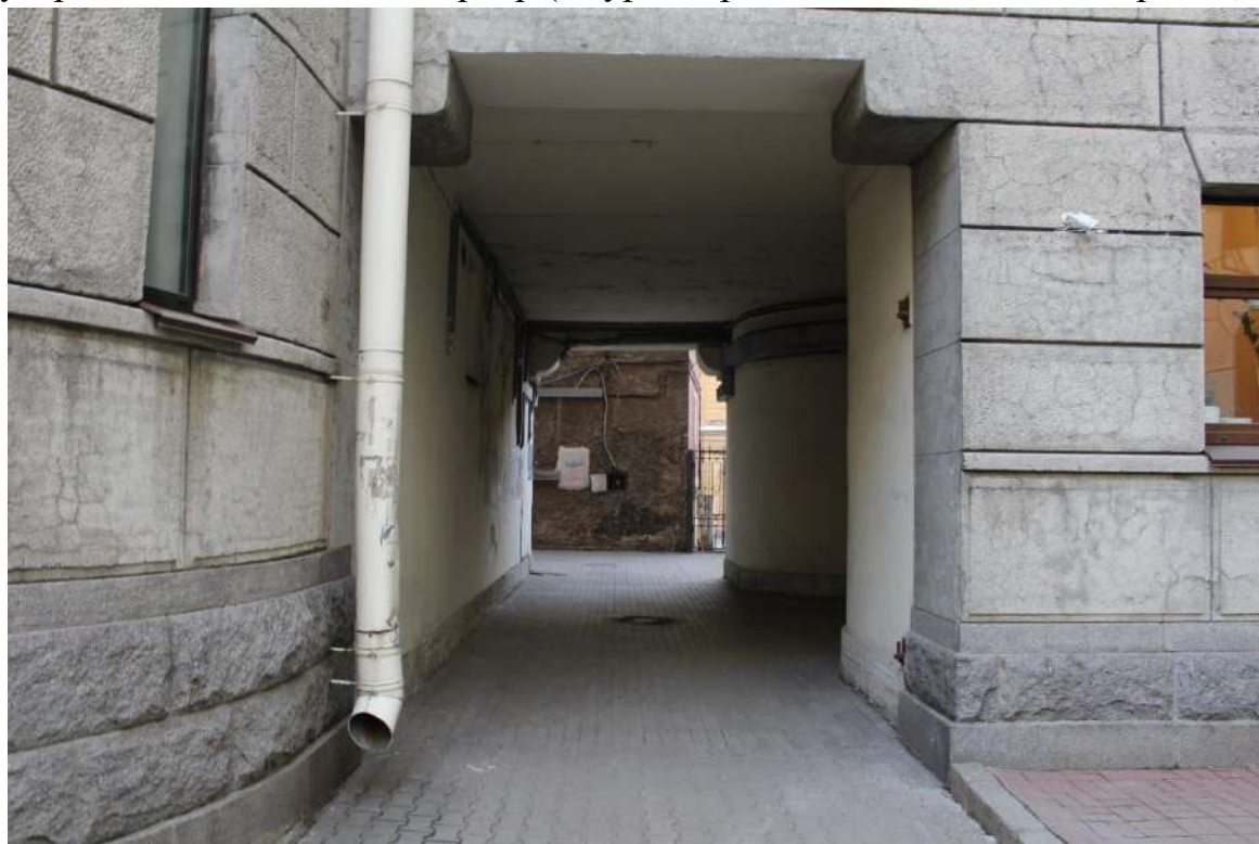
Фото 25. Вид на северо-западный воротный проезд северного корпуса выявленного объекта культурного наследия «Дом Второго Санкт-Петербургского товарищества для устройства постоянных квартир (с курдонером, палисадниками и оградой)».
