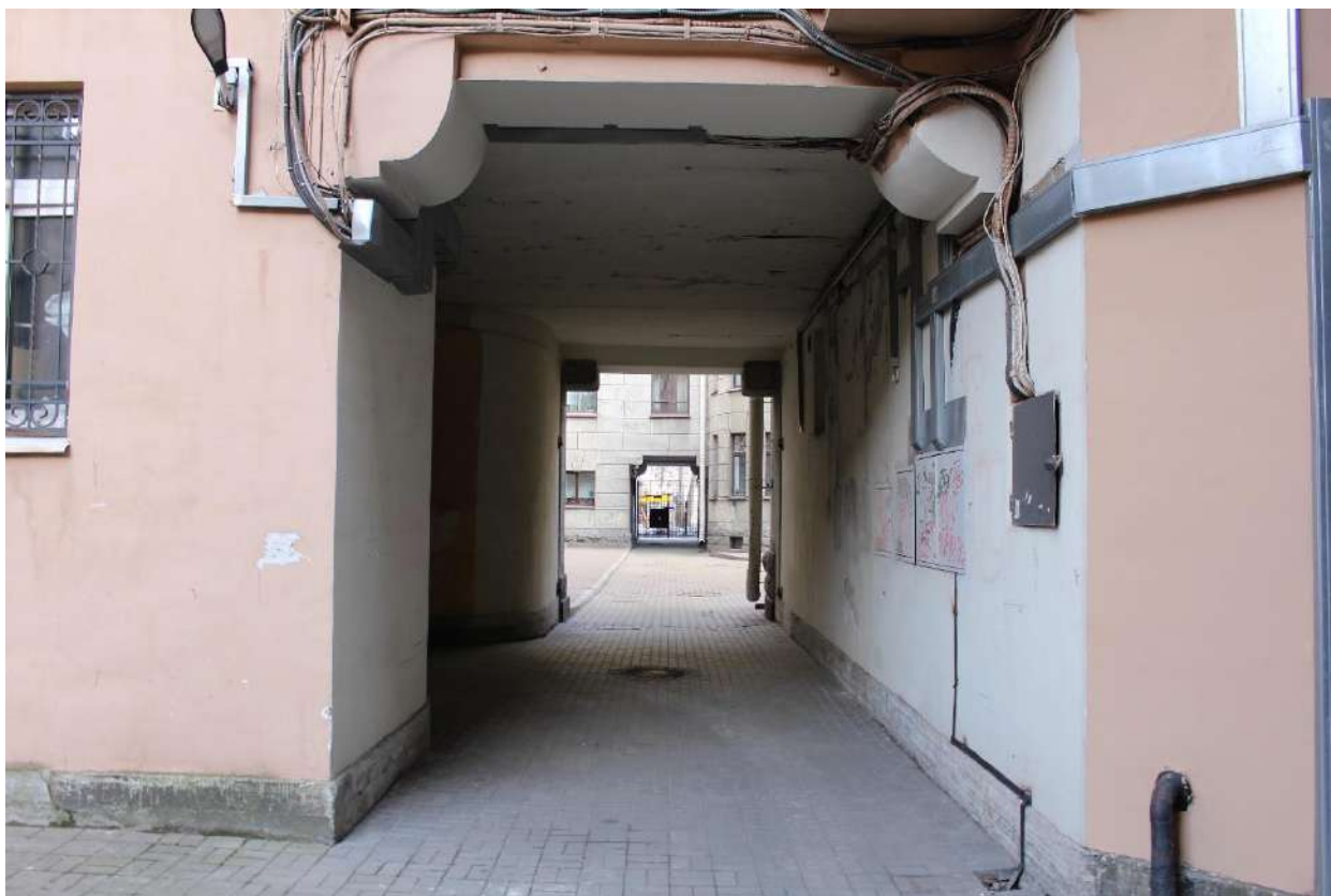
Фото 26. Вид на северо-западный воротный проезд северного корпуса выявленного объекта культурного наследия «Дом Второго Санкт-Петербургского товарищества для устройства постоянных квартир (с курдонером, палисадниками и оградой)».
