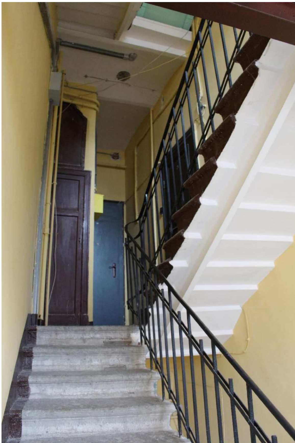
Фото 201. Выявленный объект культурного наследия «Дом Второго Санкт-Петербургского товарищества для устройства постоянных квартир (с курдонером, палисадниками и оградой)». Лестничная клетка 8ЛК в уровне 6-го этажа.
