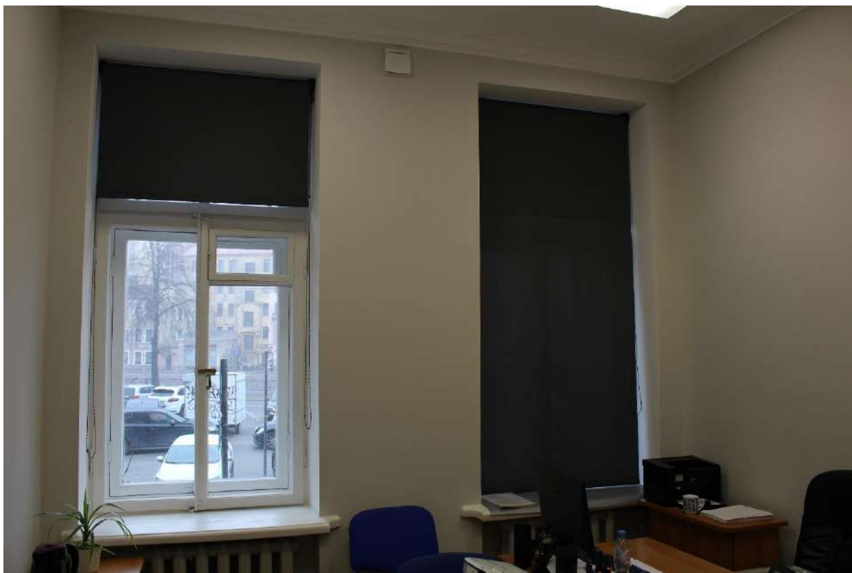
Фото 262. Выявленный объект культурного наследия «Дом Второго Санкт-Петербургского товарищества для устройства постоянных квартир (с курдонером, палисадниками и оградой)». Помещение 10-Н.
