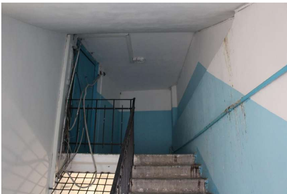
Фото 144. Выявленный объект культурного наследия «Дом Второго Санкт-Петербургского товарищества для устройства постоянных квартир (с курдонером, палисадниками и оградой)». Лестничная клетка ЗЛК, выход на чердак.
