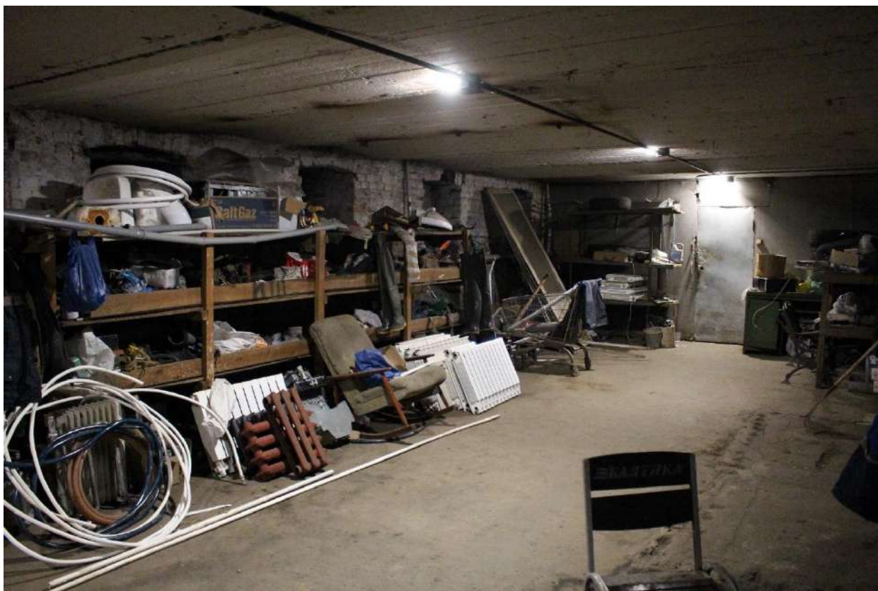
Фото 238. Выявленный объект культурного наследия «Дом Второго Санкт-Петербургского товарищества для устройства постоянных квартир (с курдонером, палисадниками и оградой)». Подвальное помещение 2-Н.
