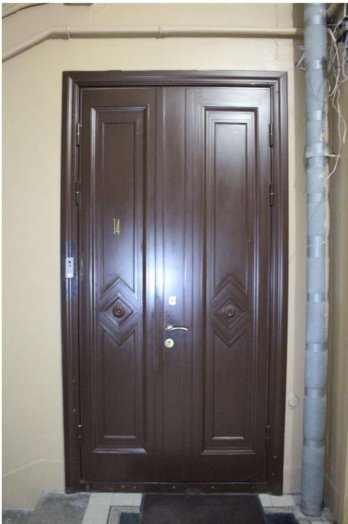
Фото 114. Выявленный объект культурного наследия «Дом Второго Санкт-Петербургского товарищества для устройства постоянных квартир (с курдонером, палисадниками и оградой)». Лестничная клетка 2ЛК в уровне 2-го этажа.
