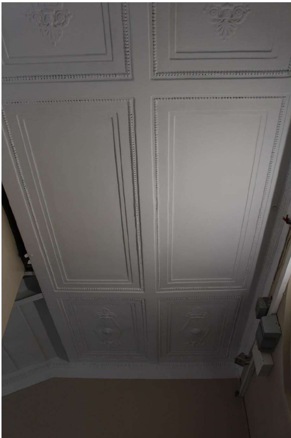
Фото 86. Выявленный объект культурного наследия «Дом Второго Санкт-Петербургского товарищества для устройства постоянных квартир (с курдонером, палисадниками и оградой)». Лестничная клетка 1ЛК в уровне 4-го этажа.
