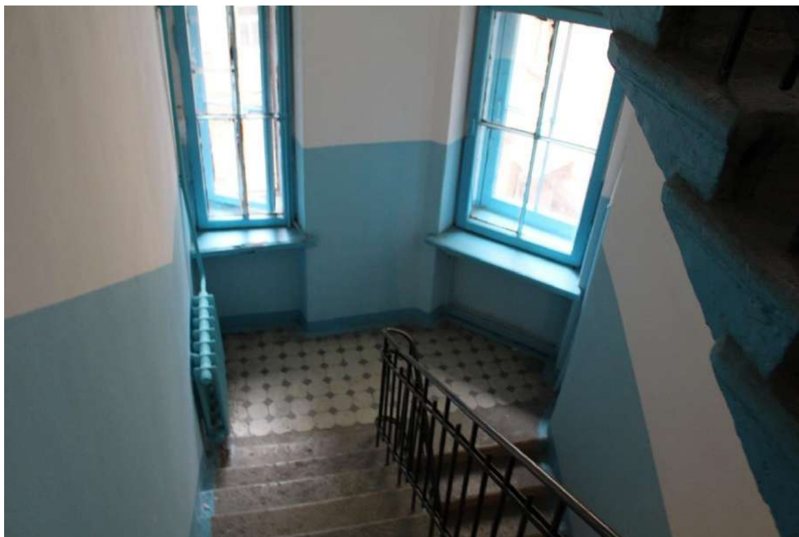
Фото 138. Выявленный объект культурного наследия «Дом Второго Санкт-Петербургского товарищества для устройства постоянных квартир (с курдонером, палисадниками и оградой)». Лестничная клетка ЗЛК в уровне 2-го – 3-го этажей.
