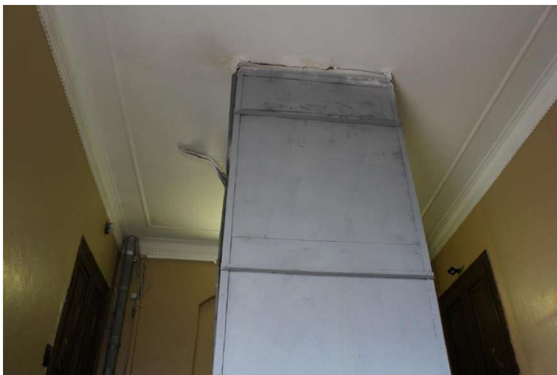
Фото 128. Выявленный объект культурного наследия «Дом Второго Санкт-Петербургского товарищества для устройства постоянных квартир (с курдонером, палисадниками и оградой)». Лестничная клетка 2ЛК в уровне 5-го этажа.
