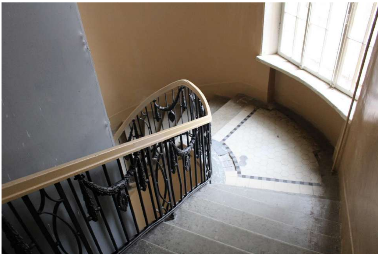
Фото 129. Выявленный объект культурного наследия «Дом Второго Санкт-Петербургского товарищества для устройства постоянных квартир (с курдонером, палисадниками и оградой)». Лестничная клетка 2ЛК в уровне 4-го – 5-го этажей.
