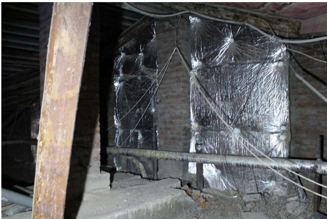
Фото 274. Выявленный объект культурного наследия «Дом Второго Санкт-Петербургского товарищества для устройства постоянных квартир (с курдонером, палисадниками и оградой)». Чердачные помещения.
