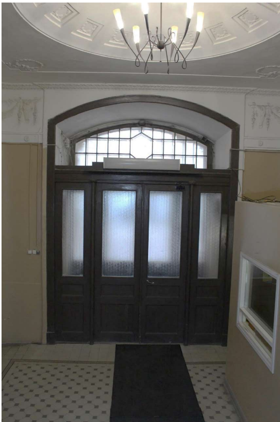
Фото 100. Выявленный объект культурного наследия «Дом Второго Санкт-Петербургского товарищества для устройства постоянных квартир (с курдонером, палисадниками и оградой)». Вестибюль 2ЛК.
