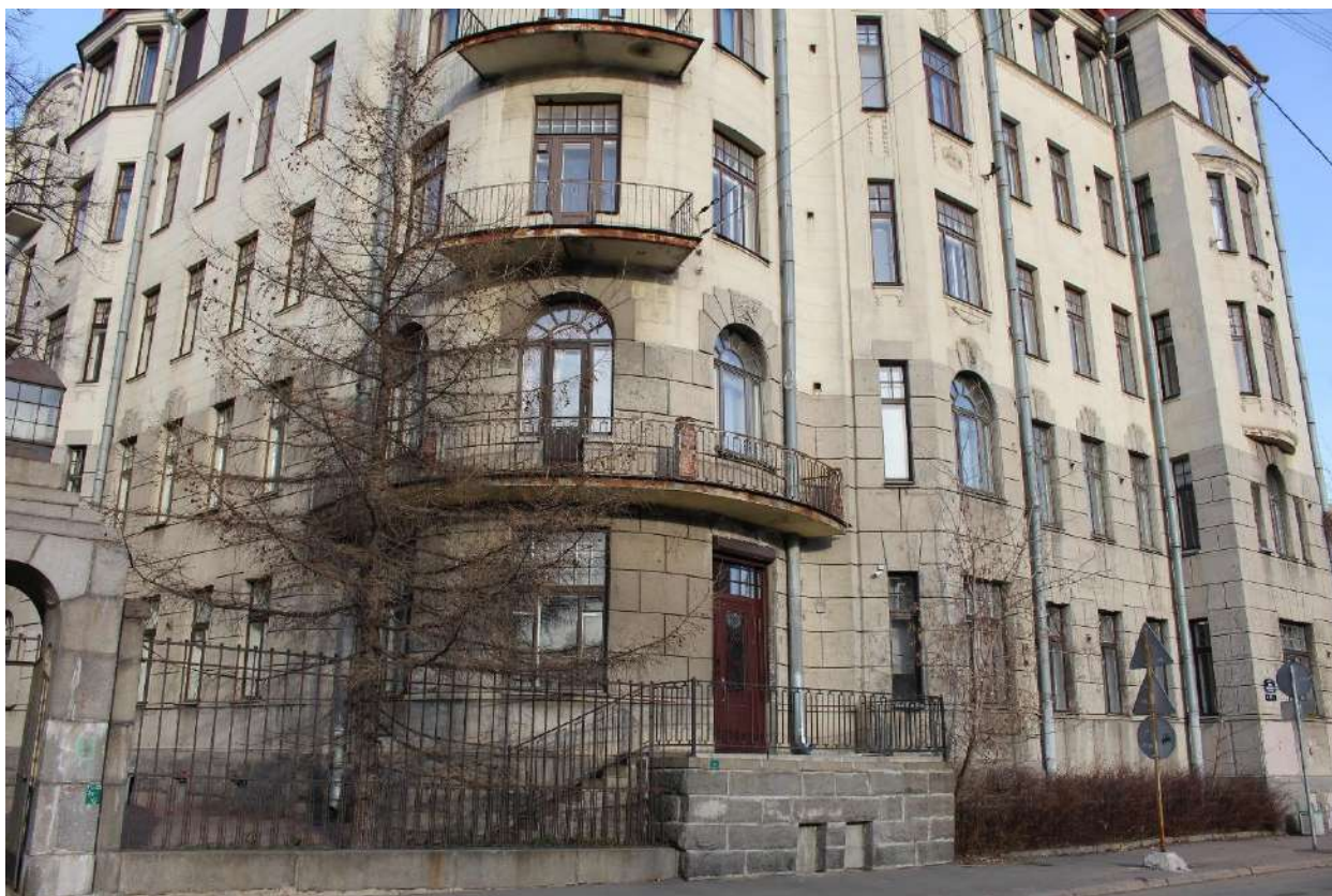
Фото 5. Вид на южный фасад юго-восточного пятиэтажного с мансардой корпуса выявленного объекта культурного наследия «Дом Второго Санкт-Петербургского товарищества для устройства постоянных квартир (с курдонером, палисадниками и оградой)».
