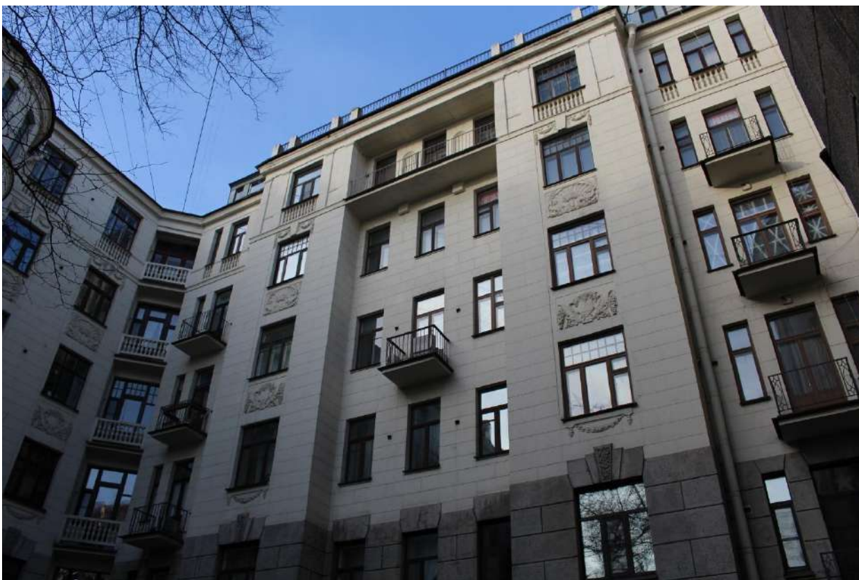
Фото 18. Вид лицевой фасад северного корпуса выявленного объекта культурного наследия «Дом Второго Санкт-Петербургского товарищества для устройства постоянных квартир (с курдонером, палисадниками и оградой)».
