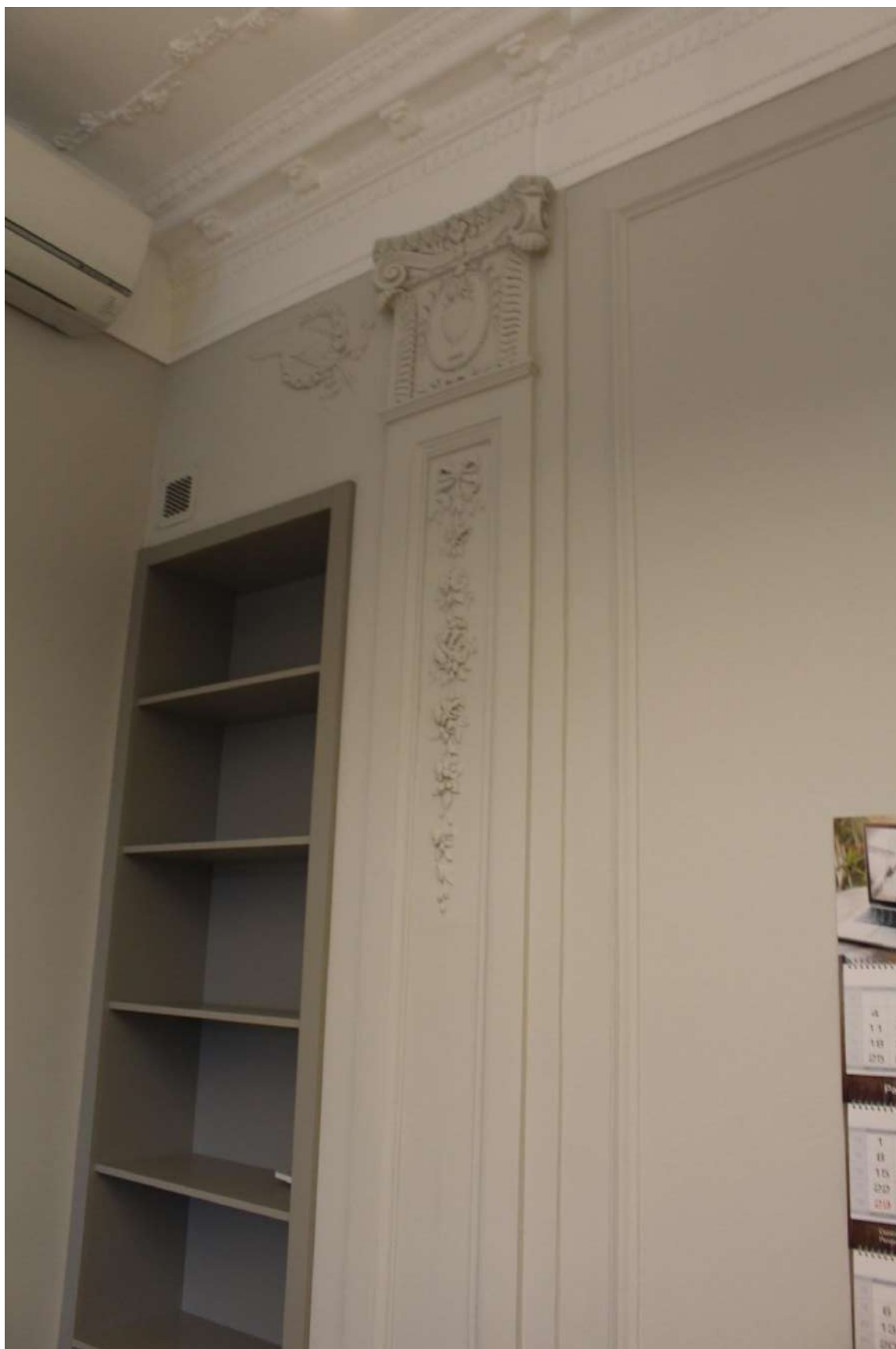
Фото 252. Выявленный объект культурного наследия «Дом Второго Санкт-Петербургского товарищества для устройства постоянных квартир (с курдонером, палисадниками и оградой)». Помещение 10-Н.
