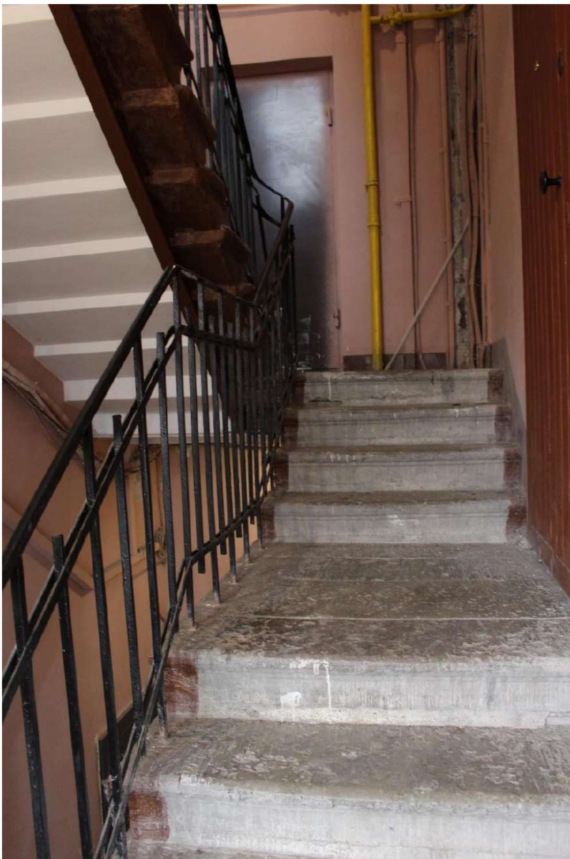
Фото 229. Выявленный объект культурного наследия «Дом Второго Санкт-Петербургского товарищества для устройства постоянных квартир (с курдонером, палисадниками и оградой)». Лестничная клетка 11ЛК в уровне 2-го этажа.
