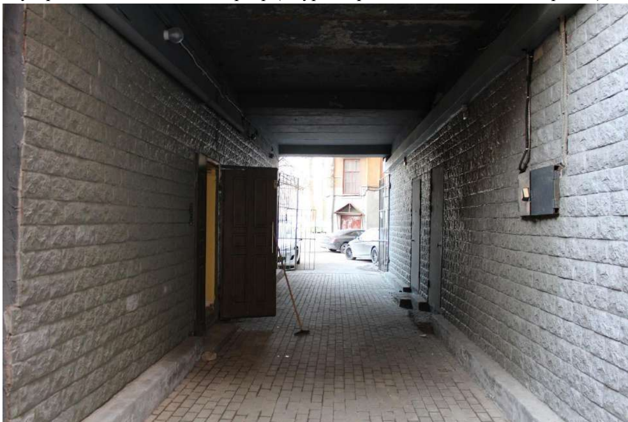
Фото 41. Вид на северный воротный проезд выявленного объекта культурного наследия «Дом Второго Санкт-Петербургского товарищества для устройства постоянных квартир (с курдонером, палисадниками и оградой)».
