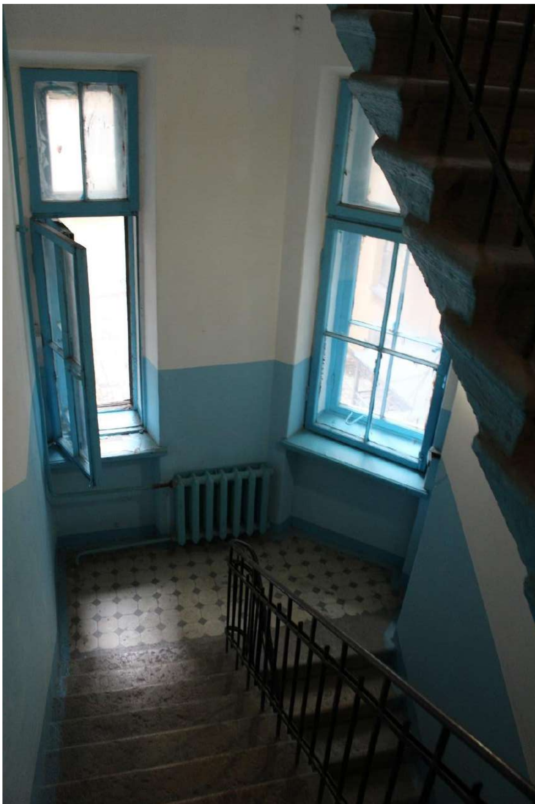
Фото 136. Выявленный объект культурного наследия «Дом Второго Санкт-Петербургского товарищества для устройства постоянных квартир (с курдонером, палисадниками и оградой)». Лестничная клетка ЗЛК в уровне 1-го – 2-го этажей.
