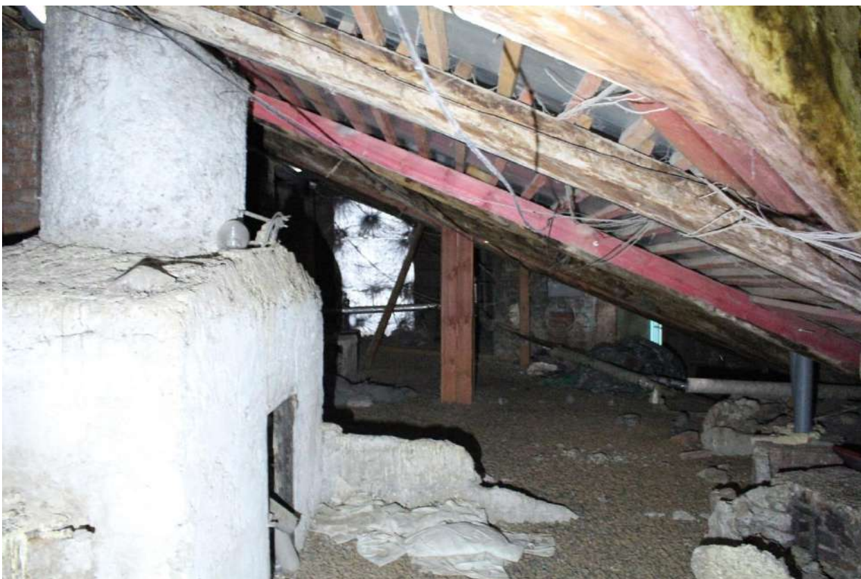
Фото 276. Выявленный объект культурного наследия «Дом Второго Санкт-Петербургского товарищества для устройства постоянных квартир (с курдонером, палисадниками и оградой)». Чердачные помещения.
