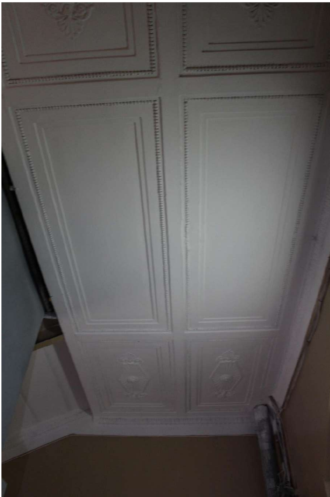
Фото 126. Выявленный объект культурного наследия «Дом Второго Санкт-Петербургского товарищества для устройства постоянных квартир (с курдонером, палисадниками и оградой)». Лестничная клетка 2ЛК в уровне 4-го этажа.
