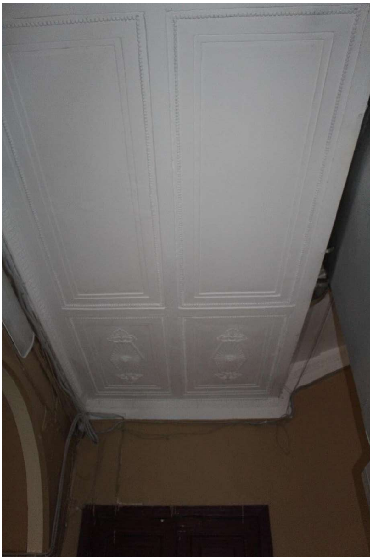
Фото 107. Выявленный объект культурного наследия «Дом Второго Санкт-Петербургского товарищества для устройства постоянных квартир (с курдонером, палисадниками и оградой)». Лестничная клетка 2ЛК в уровне 1-го этажа.
