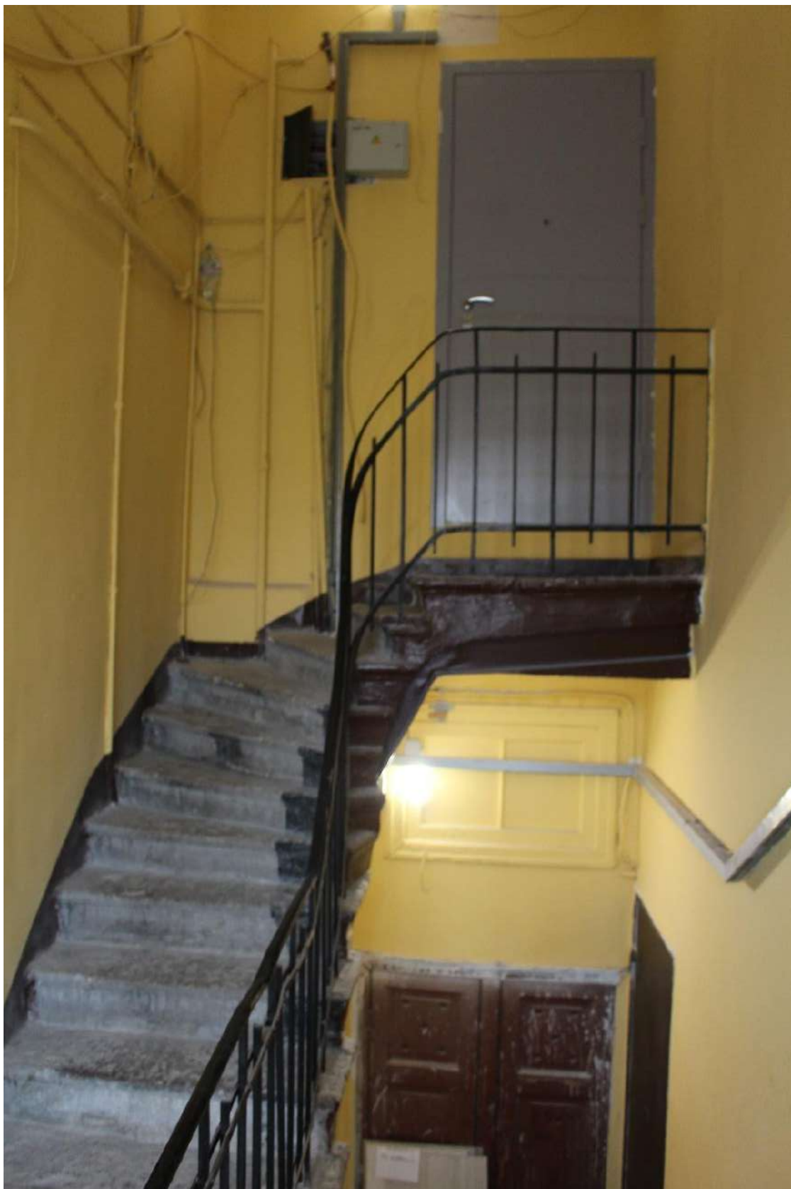
Фото 157. Выявленный объект культурного наследия «Дом Второго Санкт-Петербургского товарищества для устройства постоянных квартир (с курдонером, палисадниками и оградой)». Лестничная клетка 5ЛК в уровне 6-го этажа.
