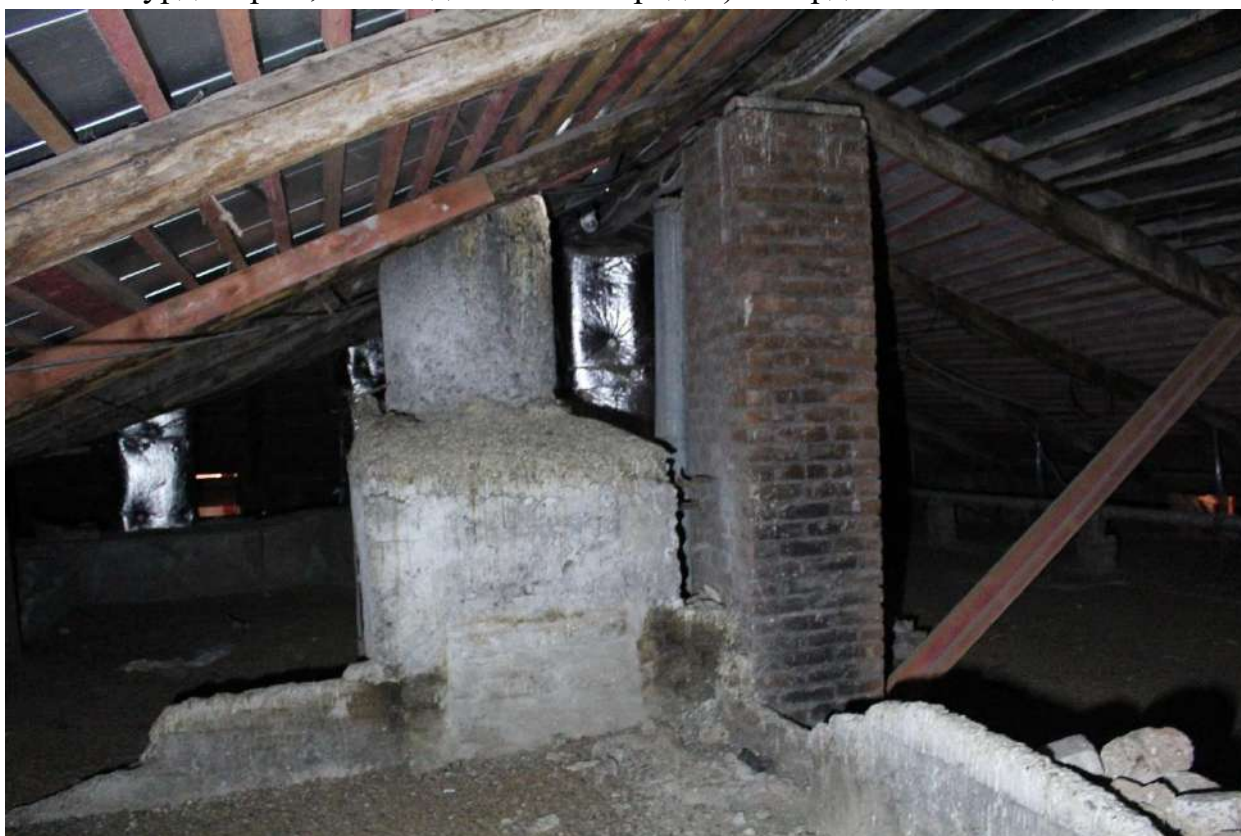
Фото 275. Выявленный объект культурного наследия «Дом Второго Санкт-Петербургского товарищества для устройства постоянных квартир (с курдонером, палисадниками и оградой)». Чердачные помещения.
