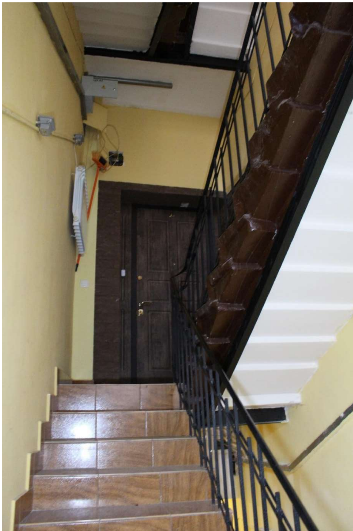
Фото 195. Выявленный объект культурного наследия «Дом Второго Санкт-Петербургского товарищества для устройства постоянных квартир (с курдонером, палисадниками и оградой)». Лестничная клетка 8ЛК в уровне 2-го этажа.
