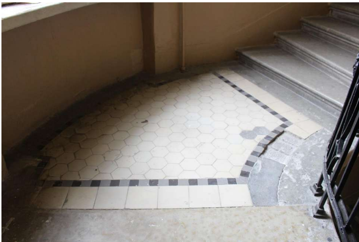
Фото 127. Выявленный объект культурного наследия «Дом Второго Санкт-Петербургского товарищества для устройства постоянных квартир (с курдонером, палисадниками и оградой)». Лестничная клетка 2ЛК в уровне 4-го – 5-го этажей.
