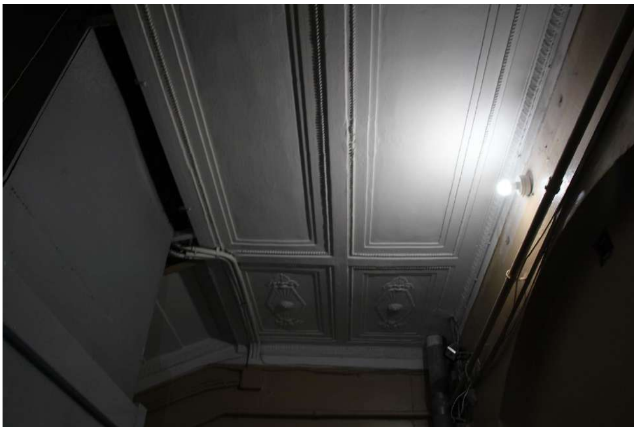
Фото 115. Выявленный объект культурного наследия «Дом Второго Санкт-Петербургского товарищества для устройства постоянных квартир (с курдонером, палисадниками и оградой)». Лестничная клетка 2ЛК в уровне 2-го этажа.
