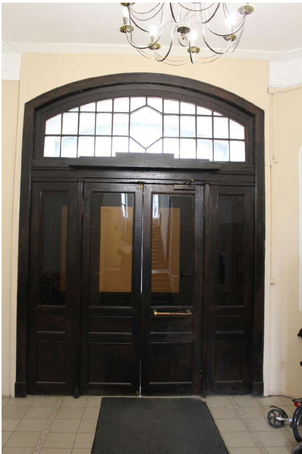
Фото 59. Выявленный объект культурного наследия «Дом Второго Санкт-Петербургского товарищества для устройства постоянных квартир (с курдонером, палисадниками и оградой)». Вестибюль лестничной клетки 1ЛК.
