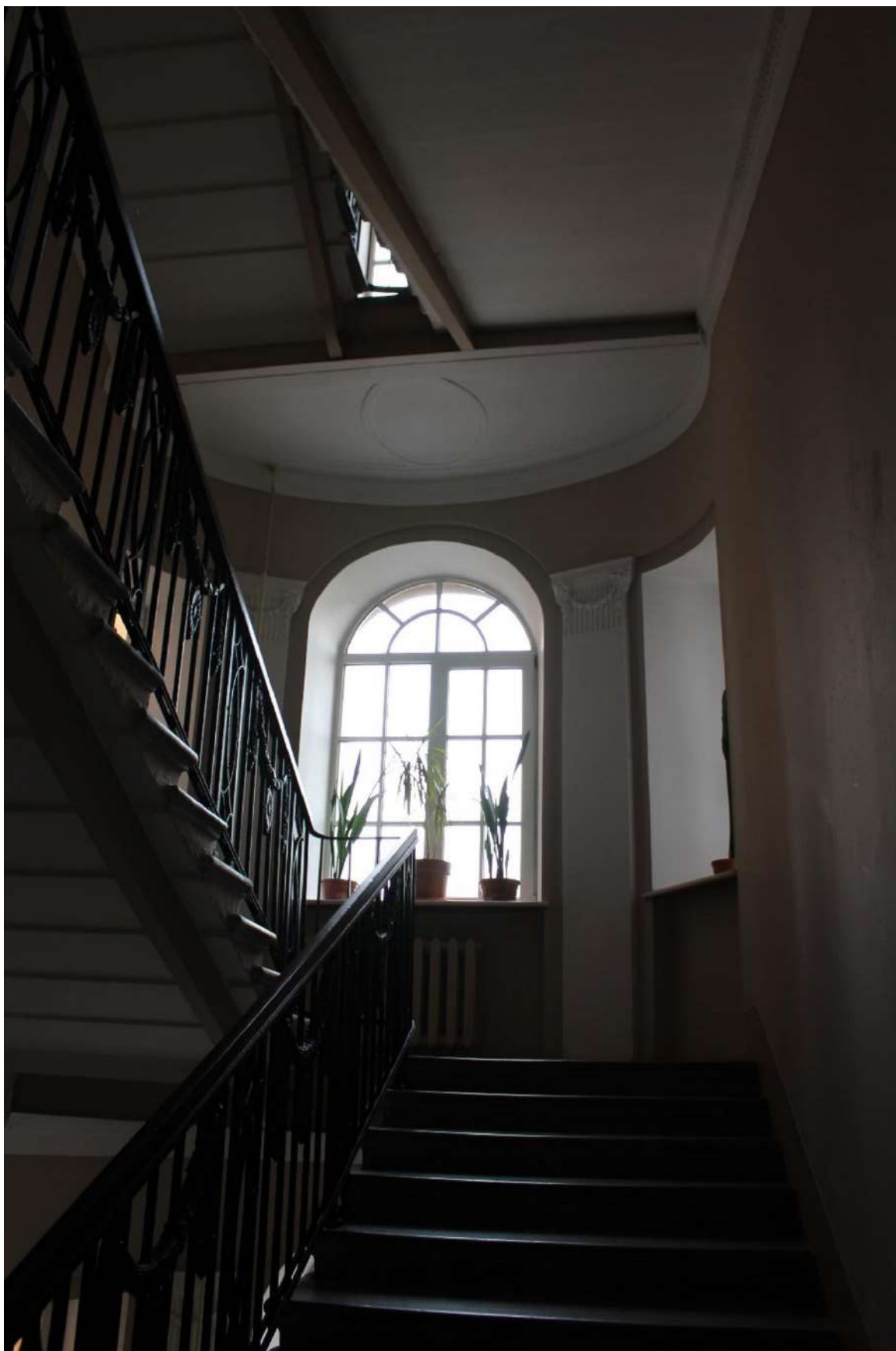
Фото 187. Выявленный объект культурного наследия «Дом Второго Санкт-Петербургского товарищества для устройства постоянных квартир (с курдонером, палисадниками и оградой)». Лестничная клетка 7ЛК в уровне 3-го – 4-го этажей.
