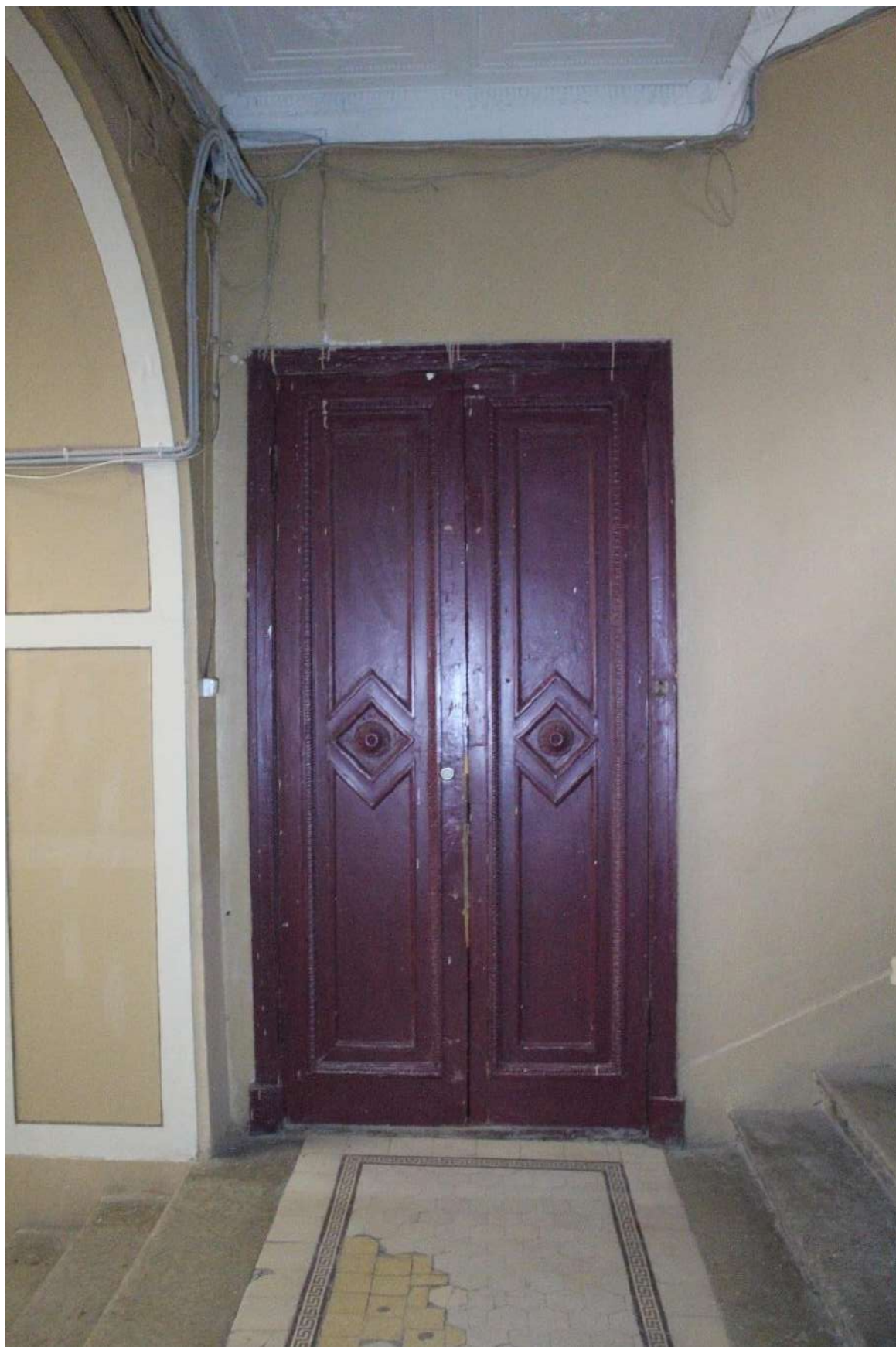
Фото 106. Выявленный объект культурного наследия «Дом Второго Санкт-Петербургского товарищества для устройства постоянных квартир (с курдонером, палисадниками и оградой)». Лестничная клетка 2ЛК в уровне 1-го этажа.
