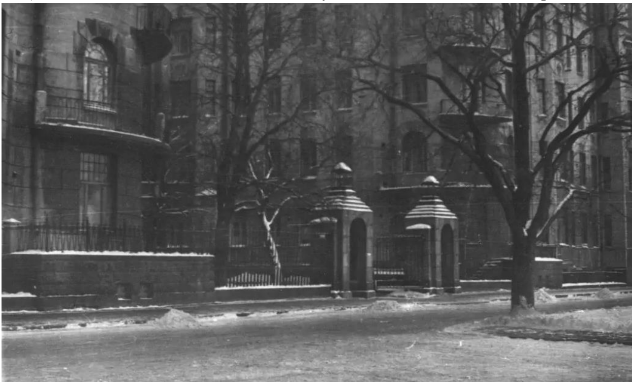
Илл. 41. Вид на ограду парадного двора дома № 19 по набережной реки Карповки. 1960-1970-е гг. (источник: https://pastvu.com/p/477124 ).
