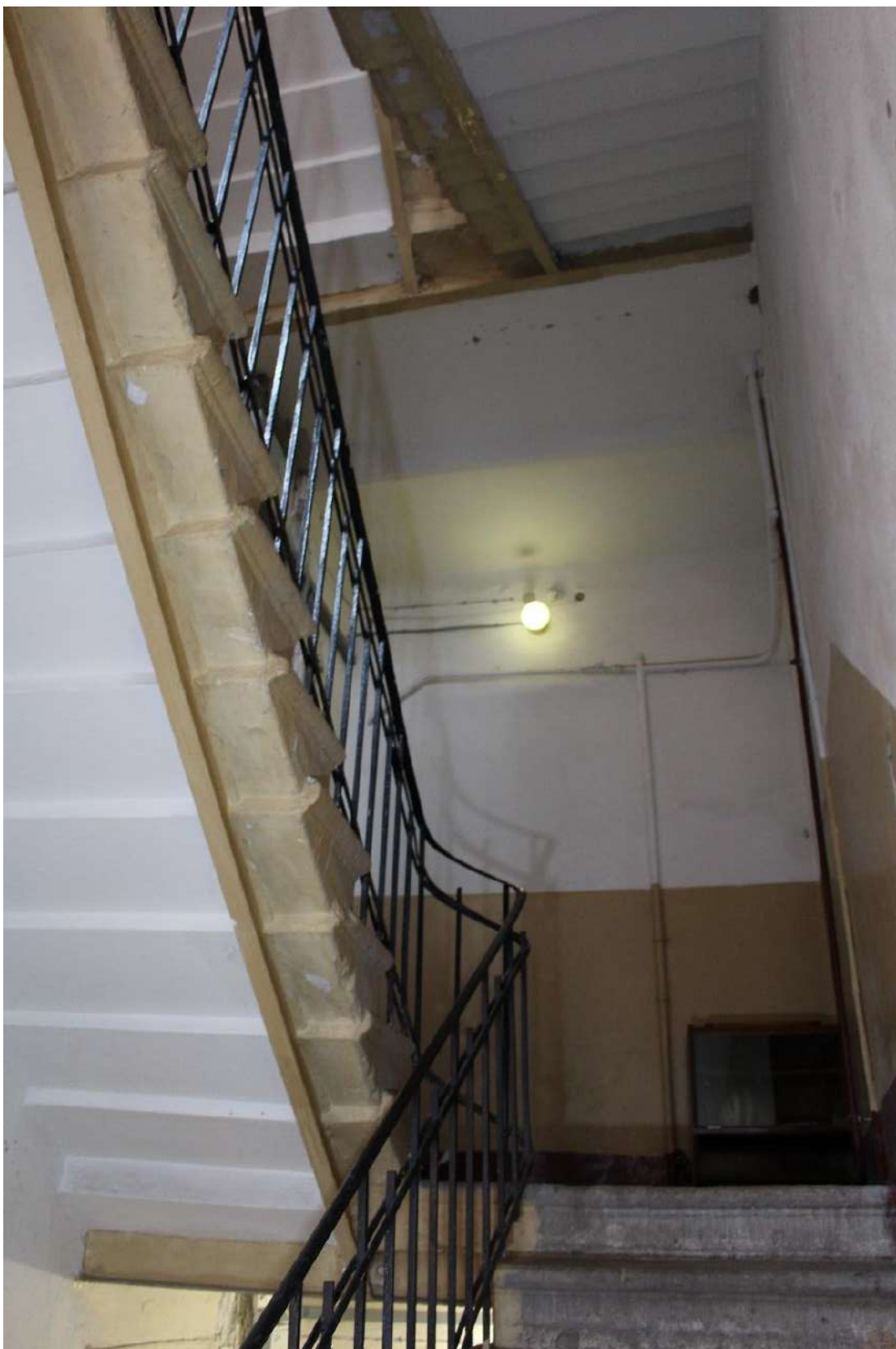
Фото 171. Выявленный объект культурного наследия «Дом Второго Санкт-Петербургского товарищества для устройства постоянных квартир (с курдонером, палисадниками и оградой)». Лестничная клетка бЛК в уровне 3-го этажа.
