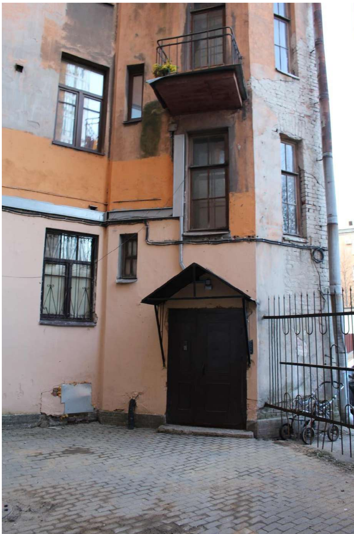
Фото 38. Вход в лестничную клетку БЛК выявленного объекта культурного наследия «Дом Второго Санкт-Петербургского товарищества для устройства постоянных квартир (с курдонером, палисадниками и оградой)».
