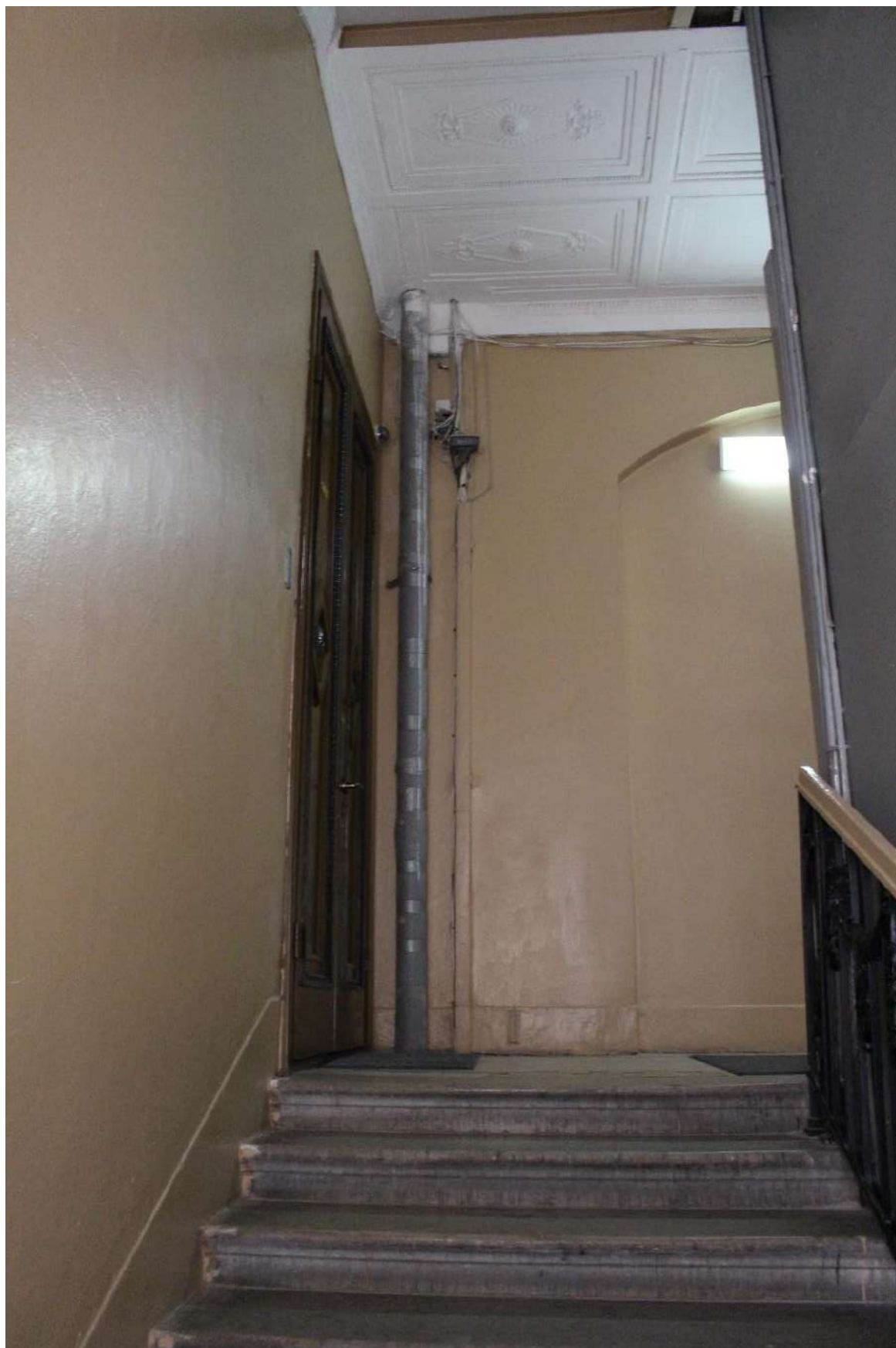
Фото 123. Выявленный объект культурного наследия «Дом Второго Санкт-Петербургского товарищества для устройства постоянных квартир (с курдонером, палисадниками и оградой)». Лестничная клетка 2ЛК в уровне 4-го этажа.
