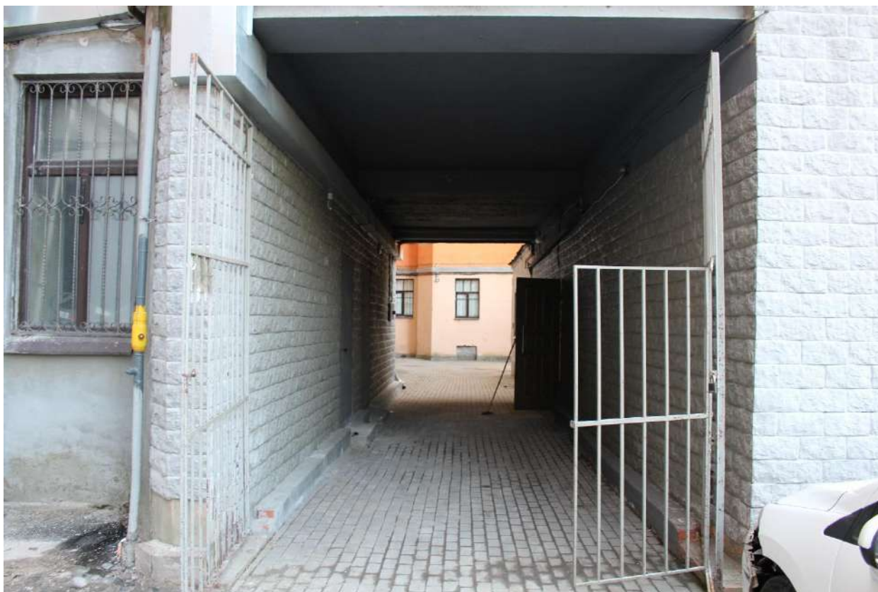
Фото 42. Вид на северный воротный проезд выявленного объекта культурного наследия «Дом Второго Санкт-Петербургского товарищества для устройства постоянных квартир (с курдонером, палисадниками и оградой)».
