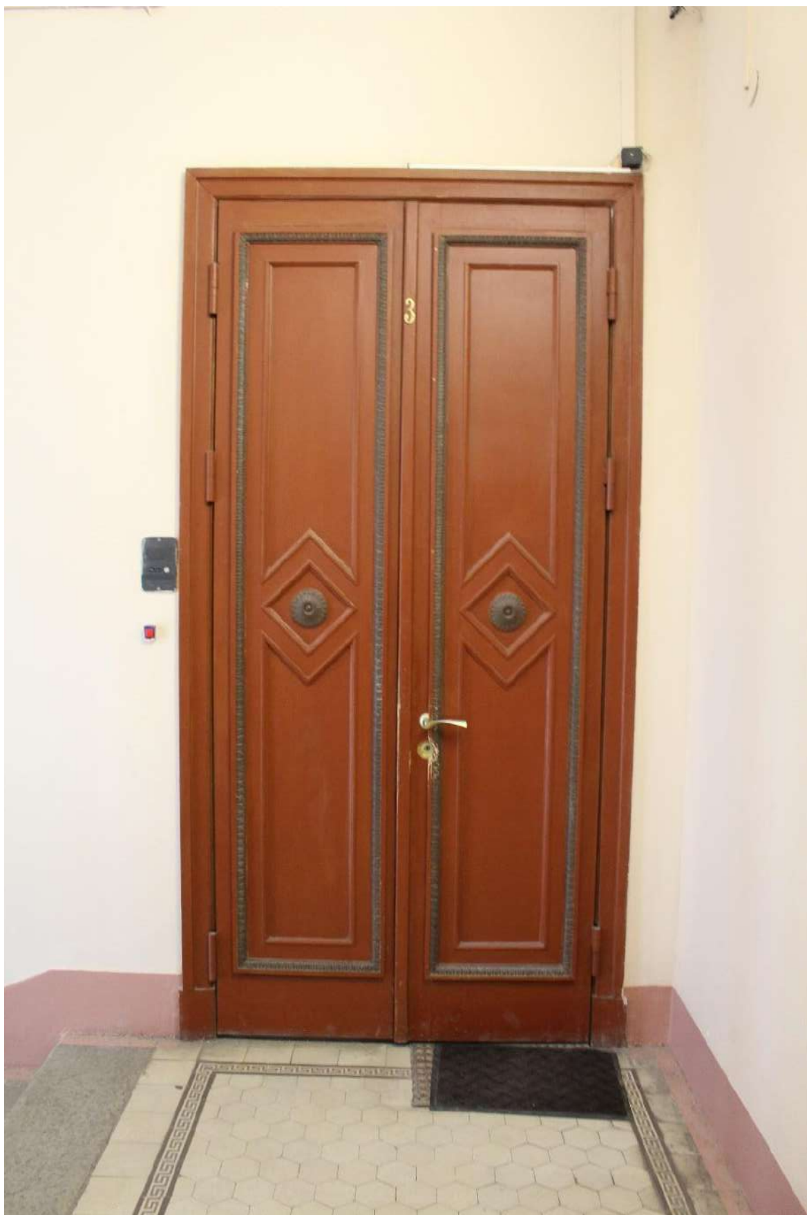
Фото 75. Выявленный объект культурного наследия «Дом Второго Санкт-Петербургского товарищества для устройства постоянных квартир (с курдонером, палисадниками и оградой)». Лестничная клетка 1ЛК в уровне 2-го этажа.
