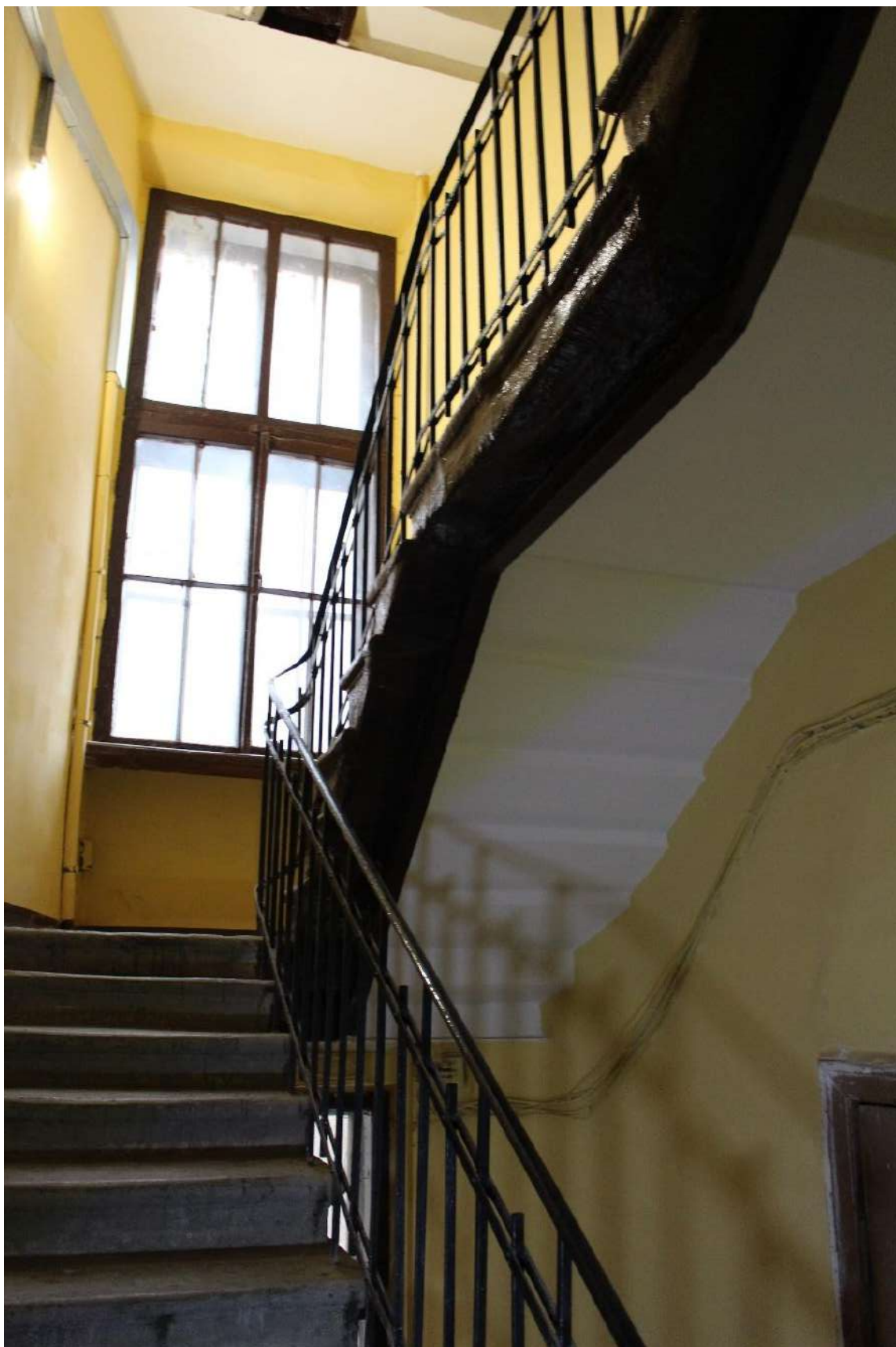
Фото 152. Выявленный объект культурного наследия «Дом Второго Санкт-Петербургского товарищества для устройства постоянных квартир (с курдонером, палисадниками и оградой)». Лестничная клетка 5ЛК в уровне 2-го – 3-го этажей.
