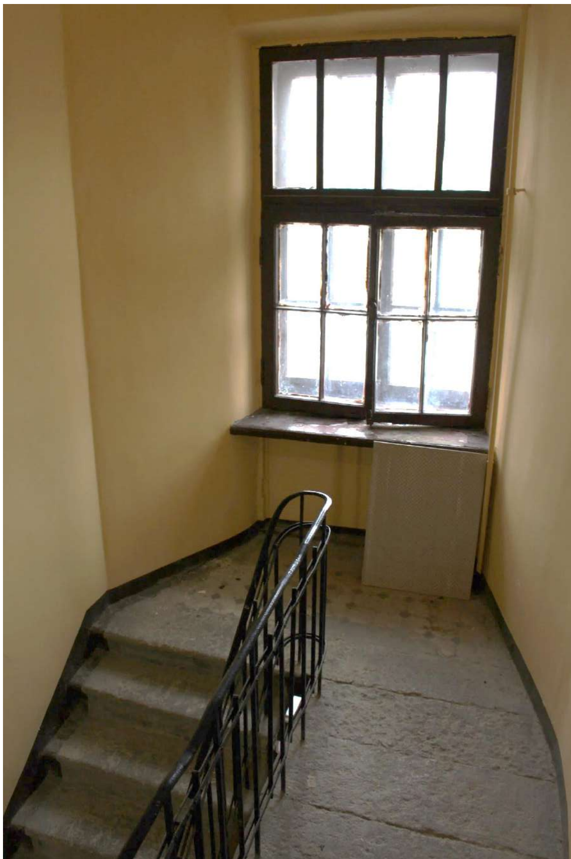
Фото 158. Выявленный объект культурного наследия «Дом Второго Санкт-Петербургского товарищества для устройства постоянных квартир (с курдонером, палисадниками и оградой)». Лестничная клетка 5ЛК в уровне 6-го этажа.
