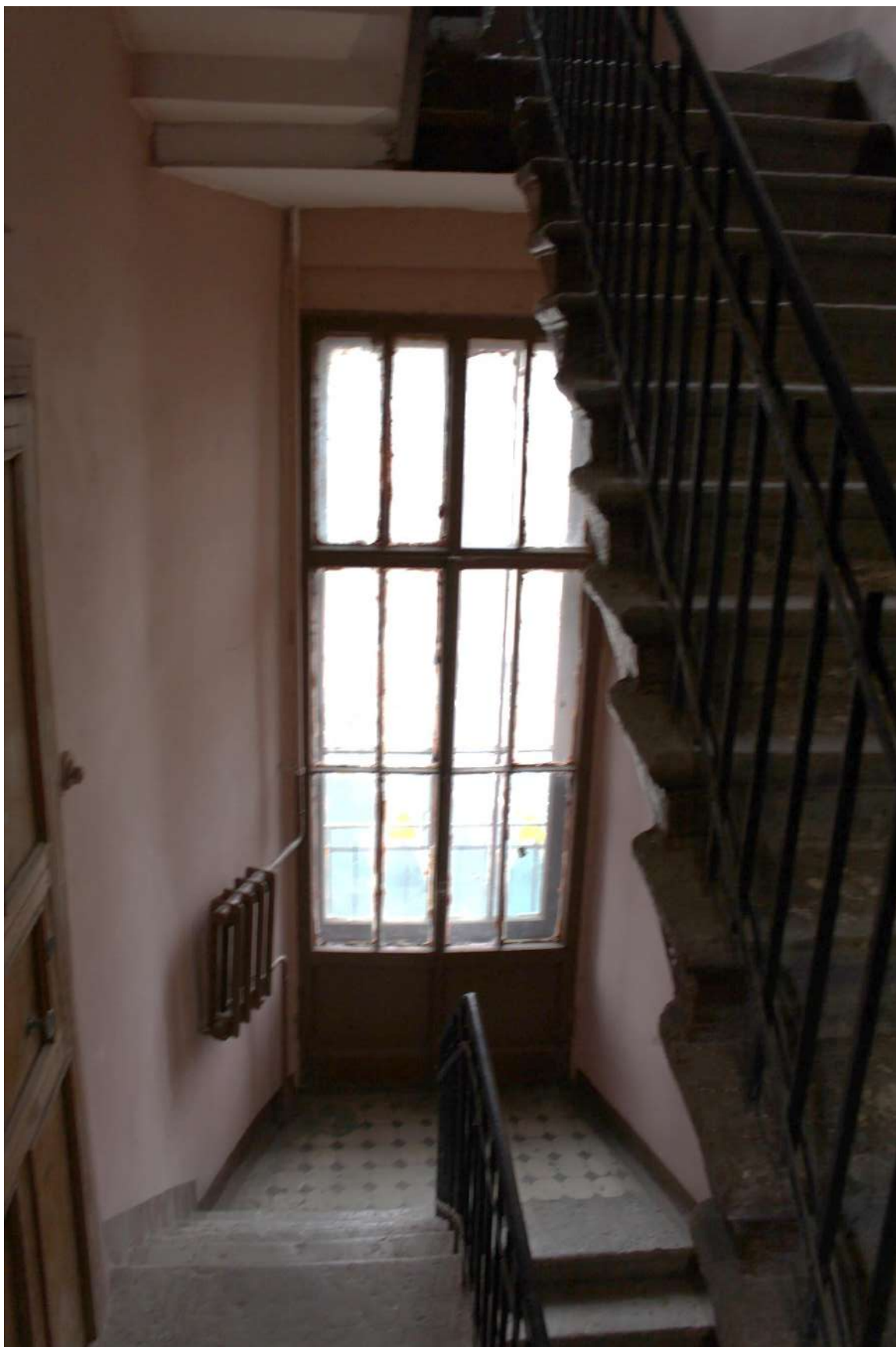
Фото 232. Выявленный объект культурного наследия «Дом Второго Санкт-Петербургского товарищества для устройства постоянных квартир (с курдонером, палисадниками и оградой)». Лестничная клетка 11ЛК в уровне 3-го этажа.
