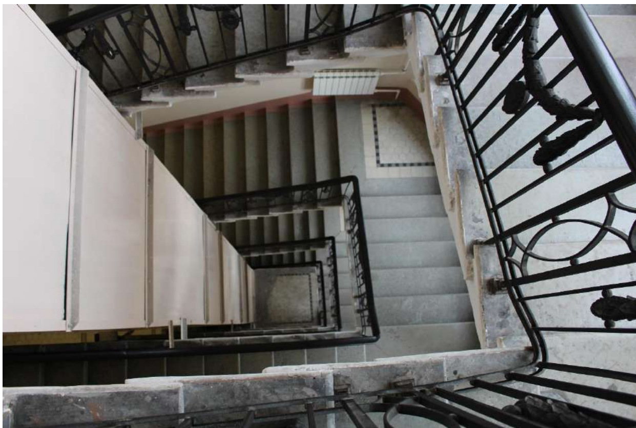
Фото 95. Выявленный объект культурного наследия «Дом Второго Санкт-Петербургского товарищества для устройства постоянных квартир (с курдонером, палисадниками и оградой)». Вид на лестничную клетку 1ЛК с 5-го этажа.
