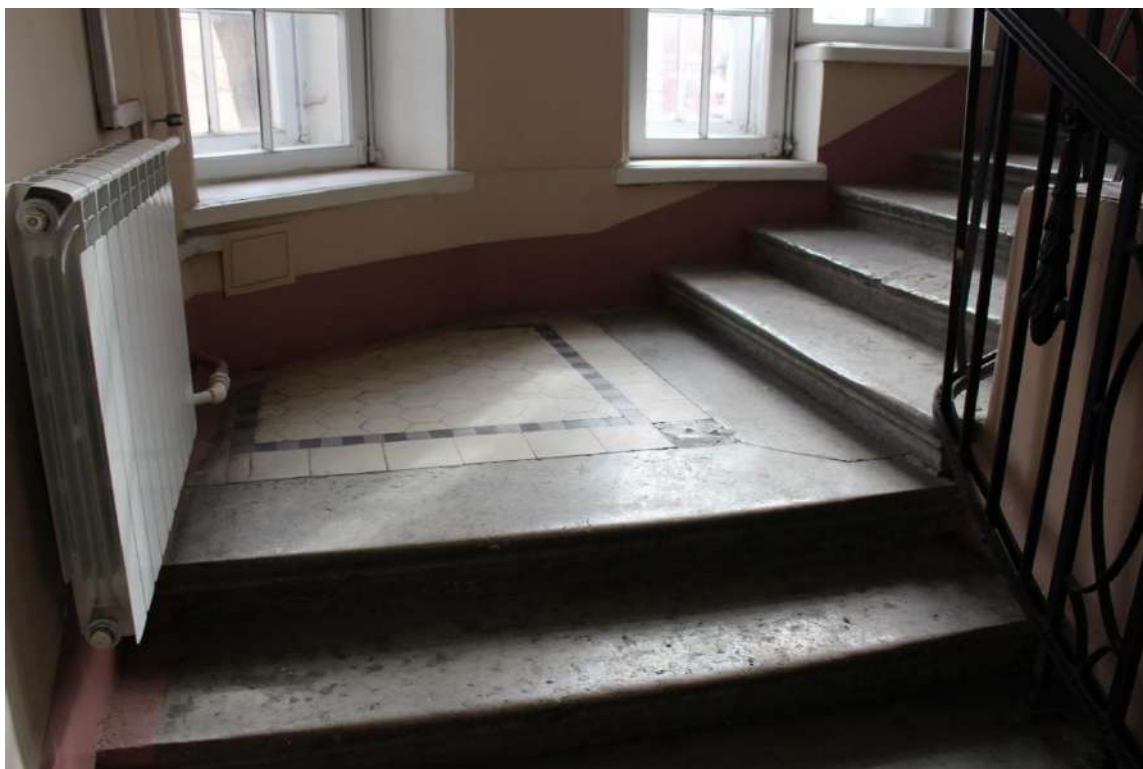
Фото 69. Выявленный объект культурного наследия «Дом Второго Санкт-Петербургского товарищества для устройства постоянных квартир (с курдонером, палисадниками и оградой)». Лестничная клетка 1ЛК в уровне 1-го - 2-го этажей.
