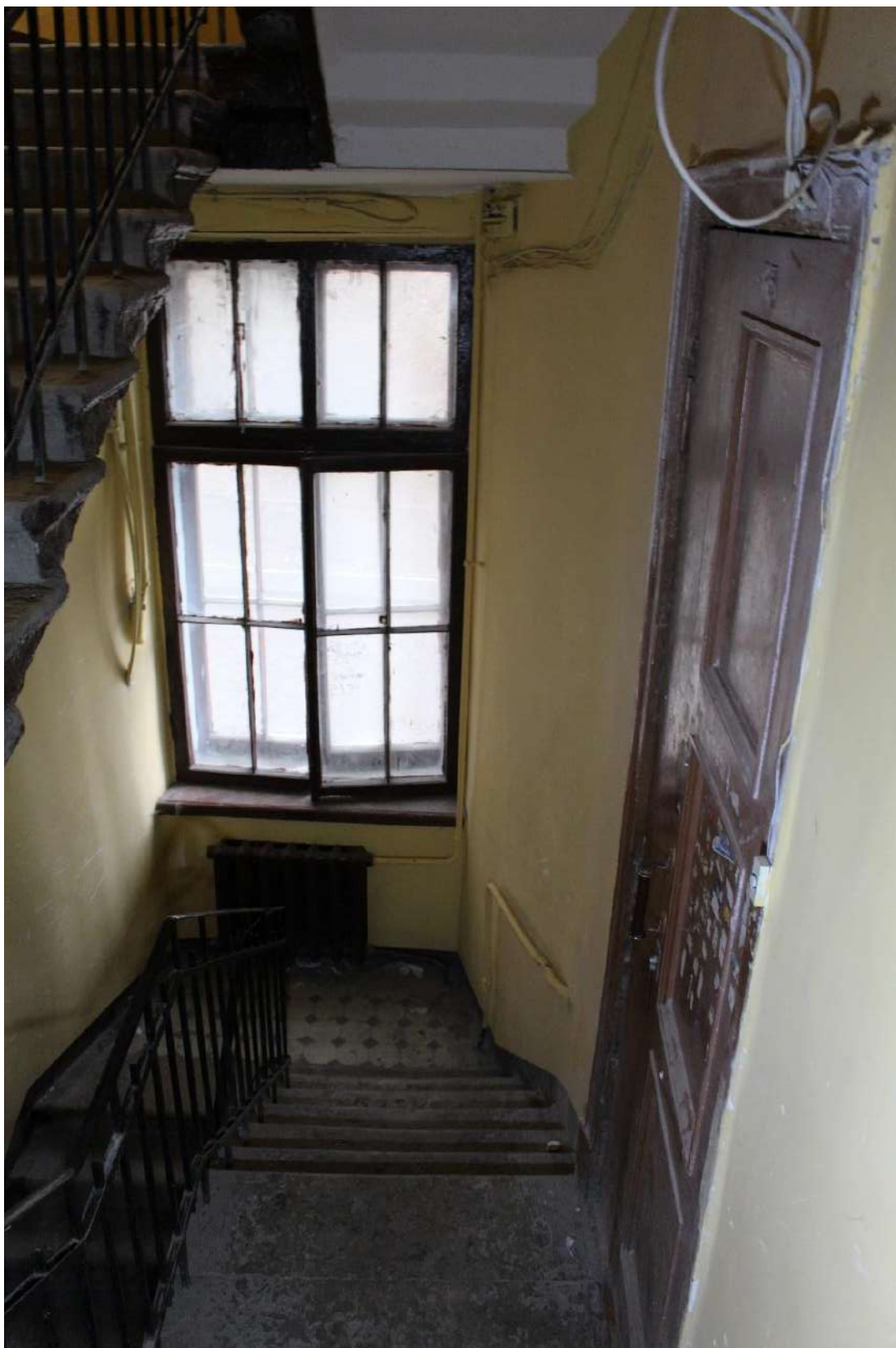
Фото 151. Выявленный объект культурного наследия «Дом Второго Санкт-Петербургского товарищества для устройства постоянных квартир (с курдонером, палисадниками и оградой)». Лестничная клетка 5ЛК в уровне 2-го этажа.
