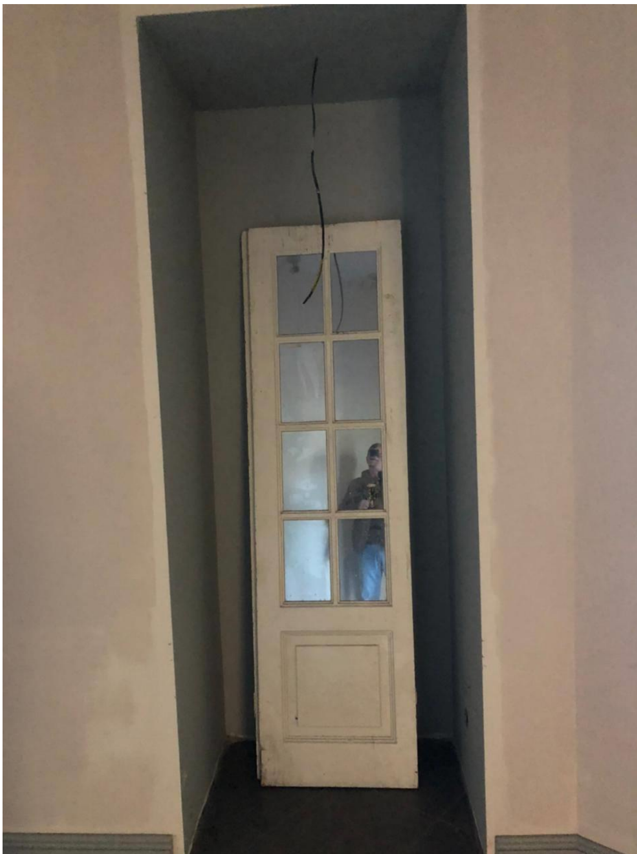
Илл. 60. Демонтированная дверь, до 2015 года была установлена в дверном проеме из помещения 40 пл. 3,6 кв. м в помещение 45 пл. 47,5 кв. м. 31.08.2021 г. (предоставлено собственником помещения 10-Н).
