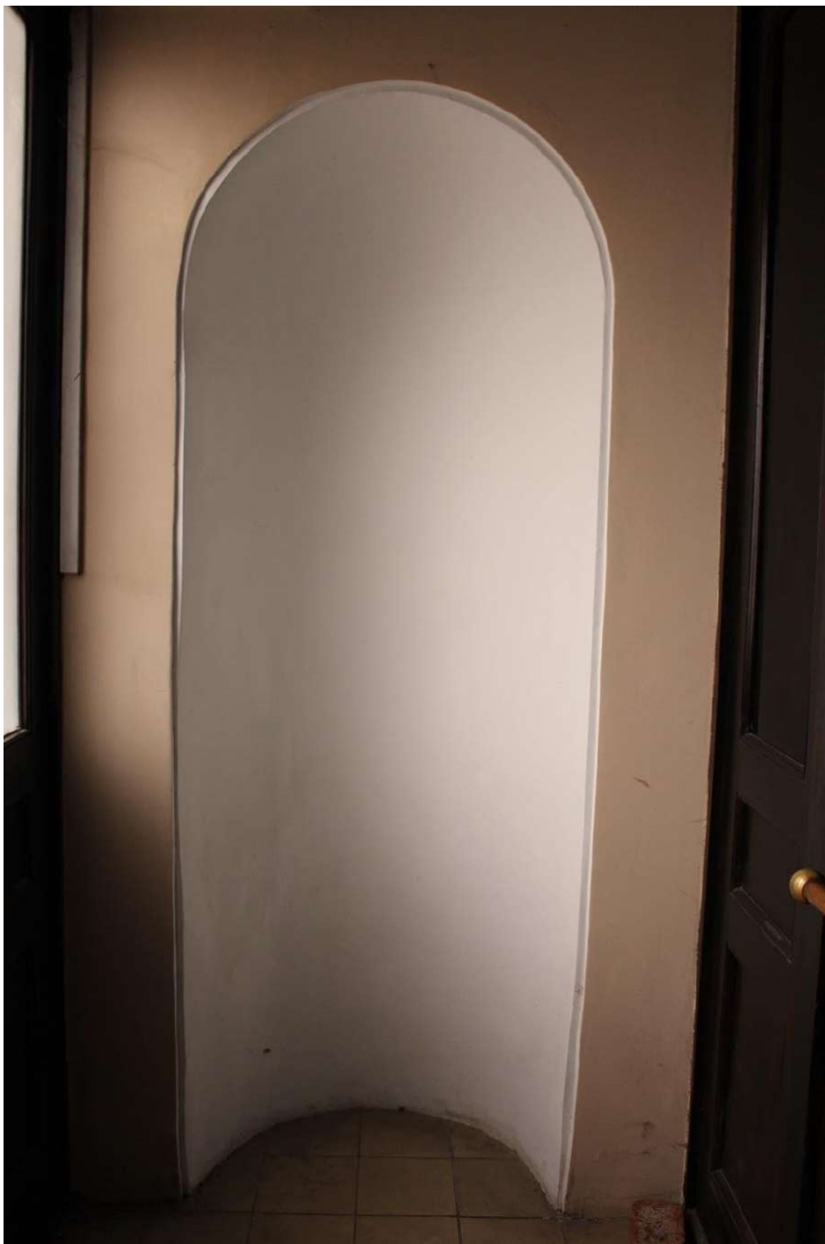
Фото 56. Выявленный объект культурного наследия «Дом Второго Санкт-Петербургского товарищества для устройства постоянных квартир (с курдонером, палисадниками и оградой)». Тамбур лестничной клетки 1ЛК.
