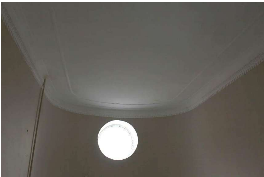
Фото 193. Выявленный объект культурного наследия «Дом Второго Санкт-Петербургского товарищества для устройства постоянных квартир (с курдонером, палисадниками и оградой)». Лестничная клетка 7ЛК в уровне 6-го этажа.
