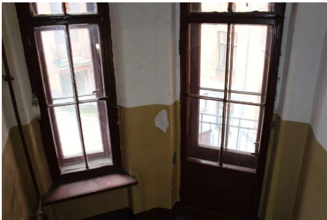
Фото 169. Выявленный объект культурного наследия «Дом Второго Санкт-Петербургского товарищества для устройства постоянных квартир (с курдонером, палисадниками и оградой)». Лестничная клетка бЛК в уровне 2-го 3-го этажей.
