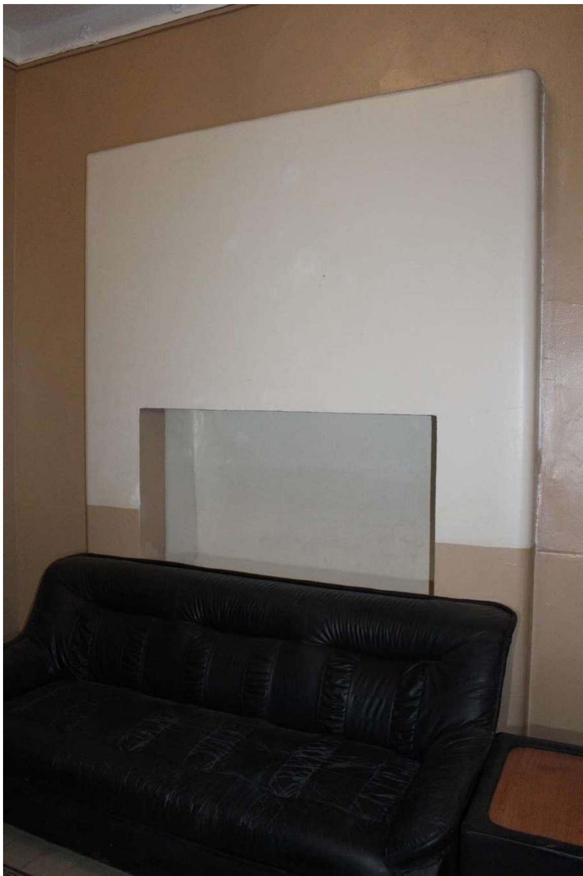
Фото 102. Выявленный объект культурного наследия «Дом Второго Санкт-Петербургского товарищества для устройства постоянных квартир (с курдонером, палисадниками и оградой)». Вестибюль 2ЛК.
