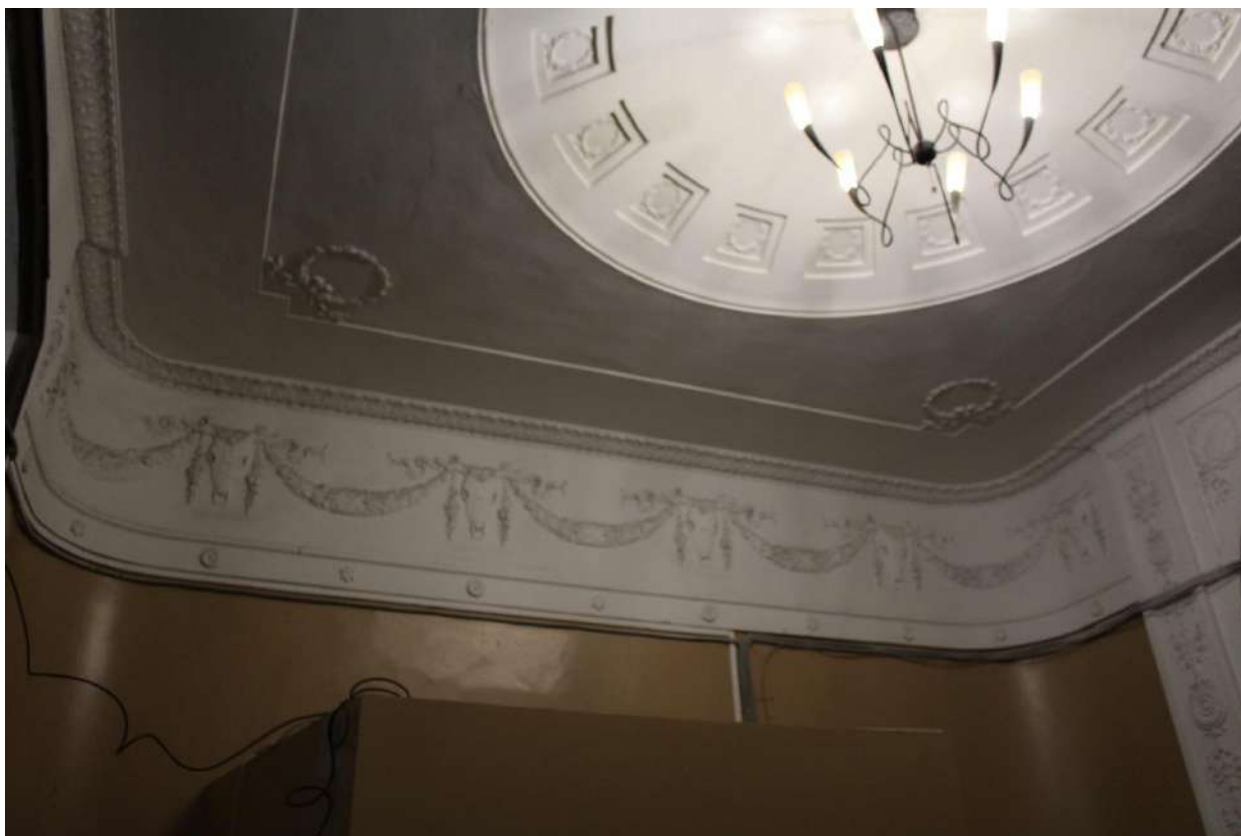
Фото 103. Выявленный объект культурного наследия «Дом Второго Санкт-Петербургского товарищества для устройства постоянных квартир (с курдонером, палисадниками и оградой)». Вестибюль 2ЛК.
