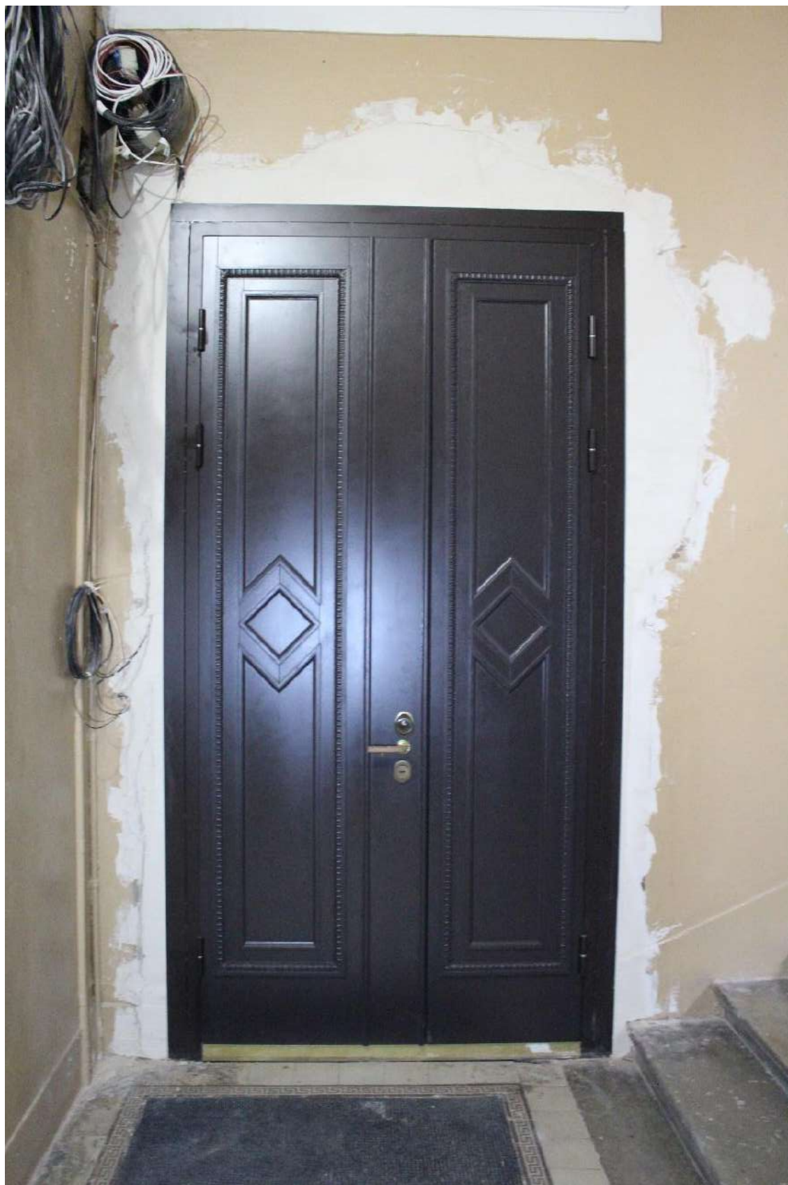
Фото 113. Выявленный объект культурного наследия «Дом Второго Санкт-Петербургского товарищества для устройства постоянных квартир (с курдонером, палисадниками и оградой)». Лестничная клетка 2ЛК в уровне 2-го этажа.
