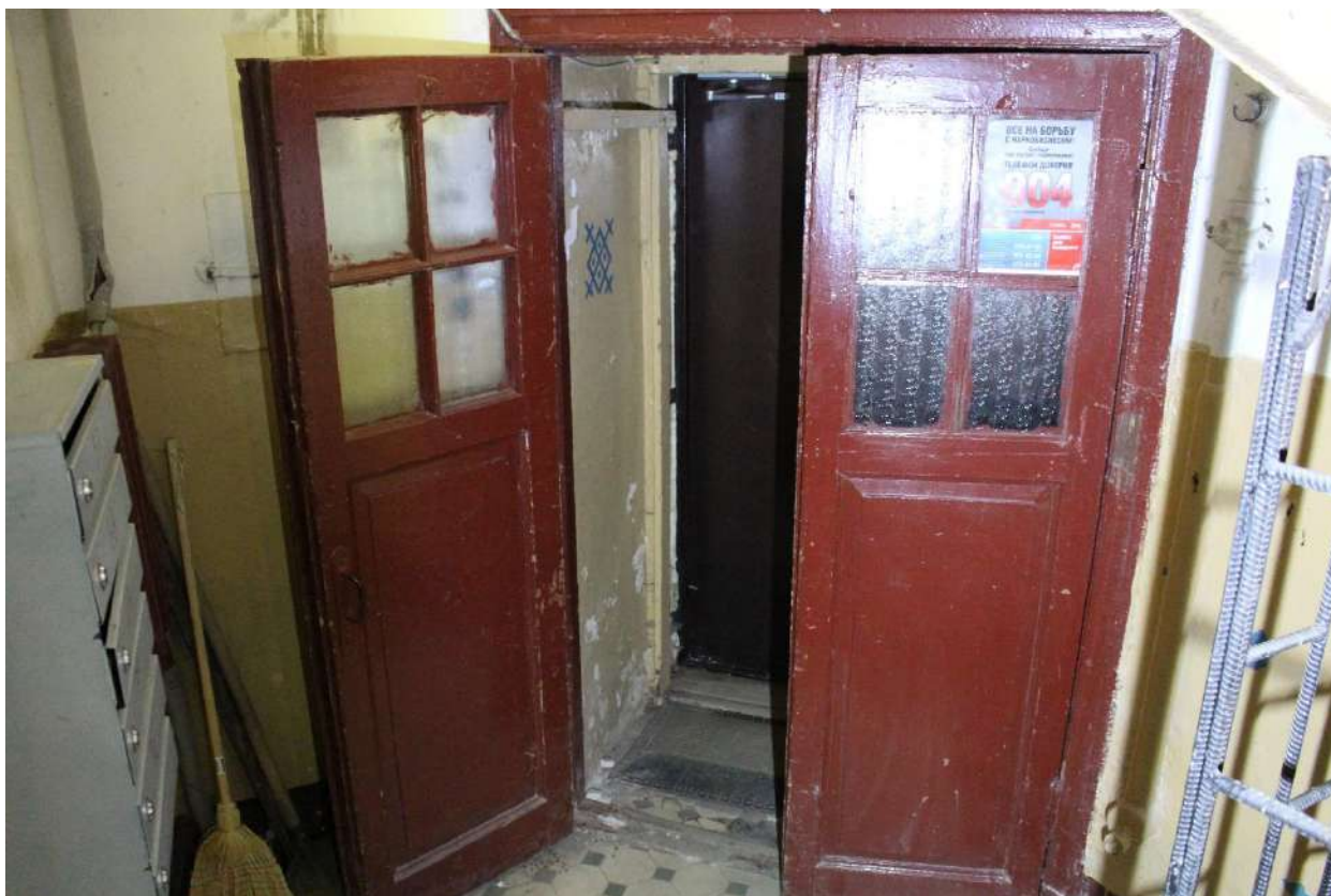
Фото 162. Выявленный объект культурного наследия «Дом Второго Санкт-Петербургского товарищества для устройства постоянных квартир (с курдонером, палисадниками и оградой)». Лестничная клетка 6ЛК в уровне 1-го этажа.
