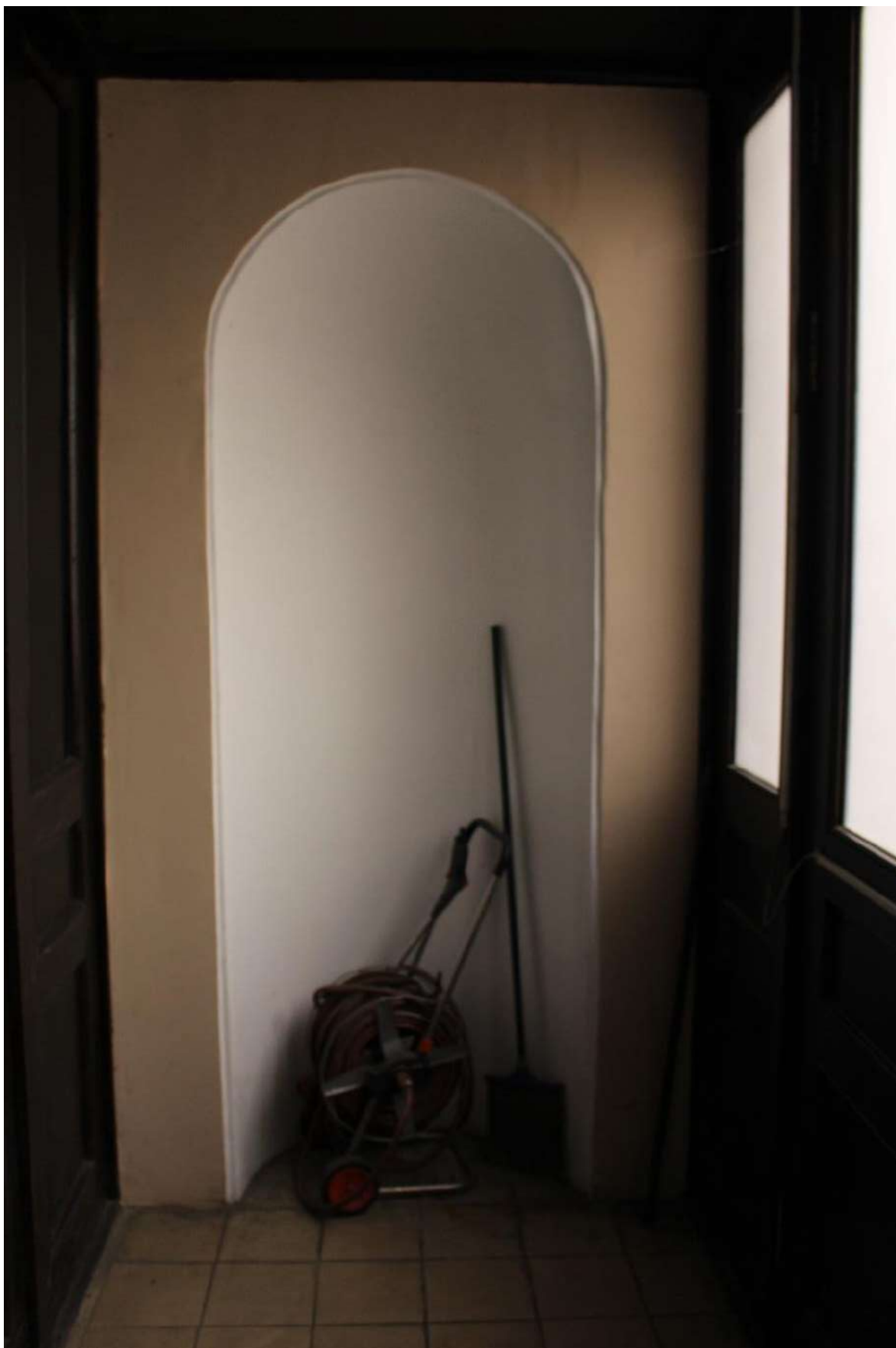
Фото 57. Выявленный объект культурного наследия «Дом Второго Санкт-Петербургского товарищества для устройства постоянных квартир (с курдонером, палисадниками и оградой)». Тамбур лестничной клетки 1ЛК.
