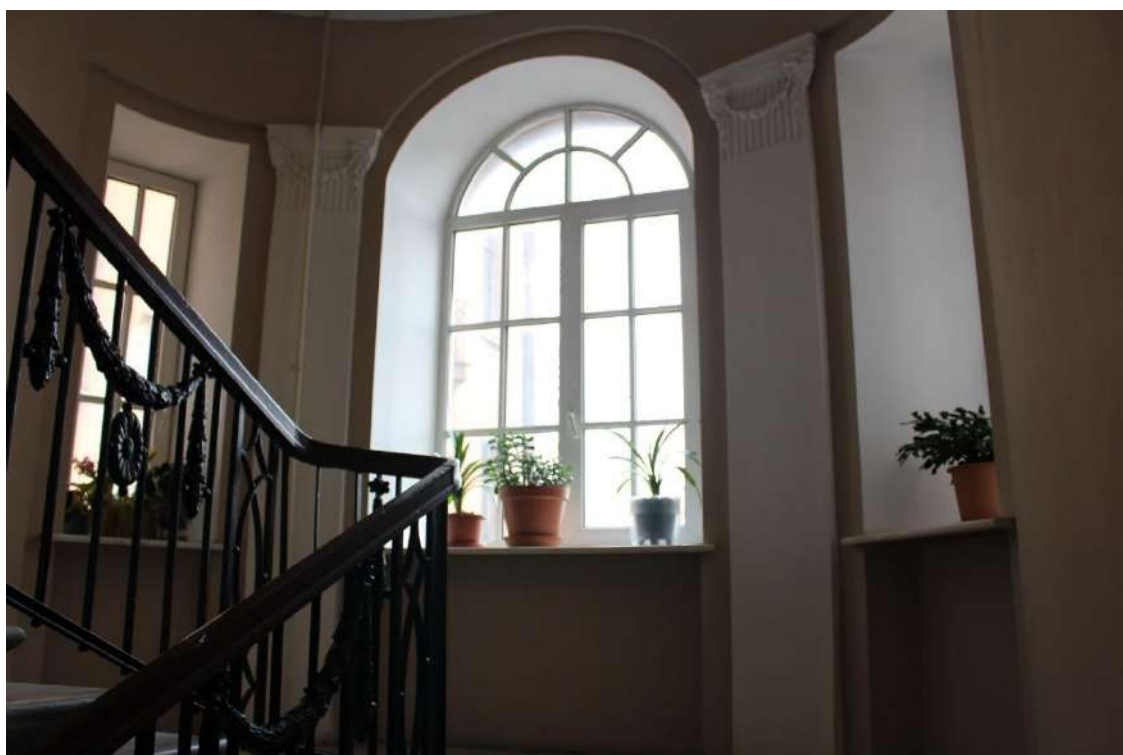
Фото 189. Выявленный объект культурного наследия «Дом Второго Санкт-Петербургского товарищества для устройства постоянных квартир (с курдонером, палисадниками и оградой)». Лестничная клетка 7ЛК в уровне 4-го – 5-го этажей.
