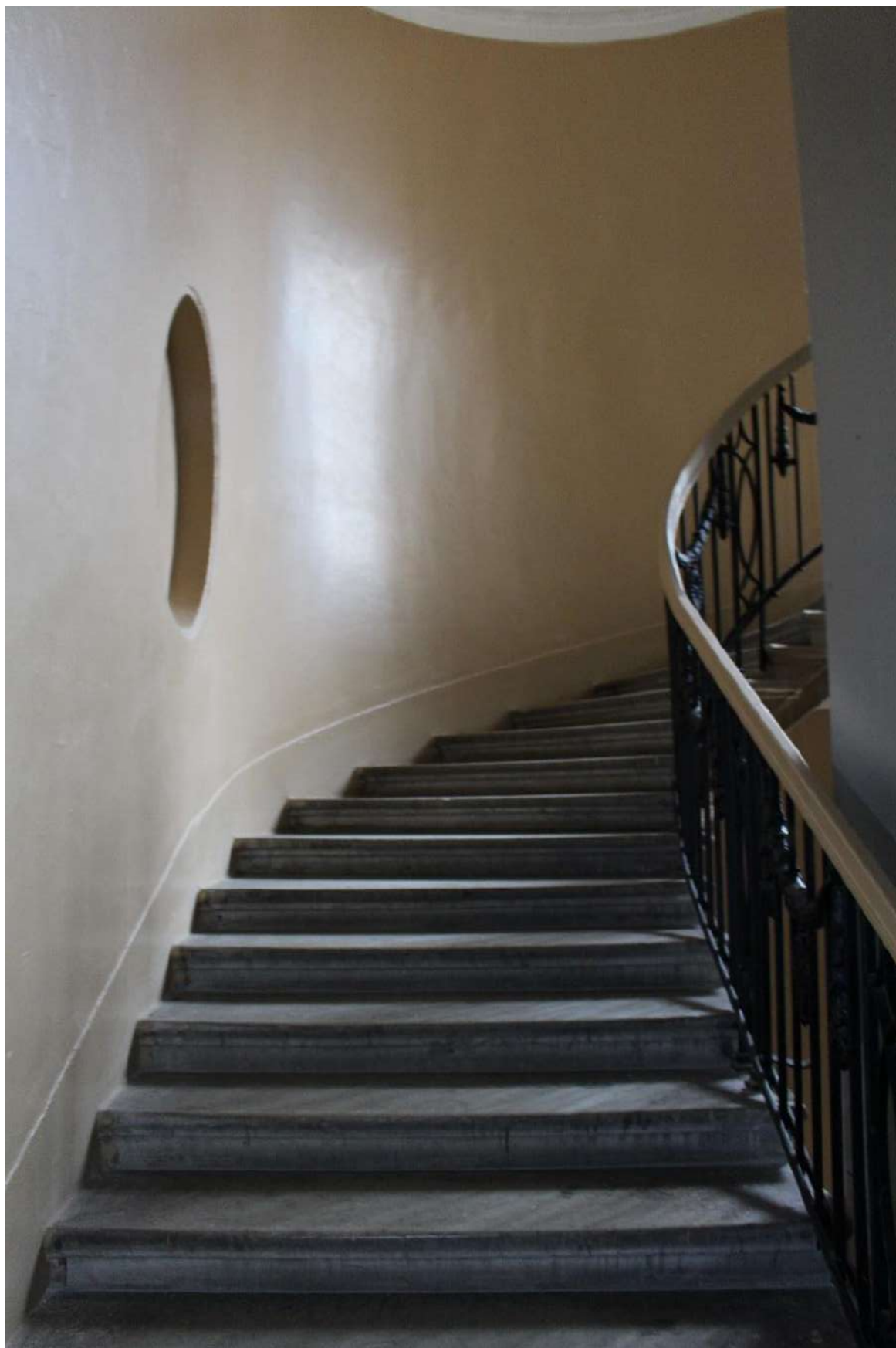
Фото 121. Выявленный объект культурного наследия «Дом Второго Санкт-Петербургского товарищества для устройства постоянных квартир (с курдонером, палисадниками и оградой)». Лестничная клетка 2ЛК в уровне 3-го – 4-го этажей.
