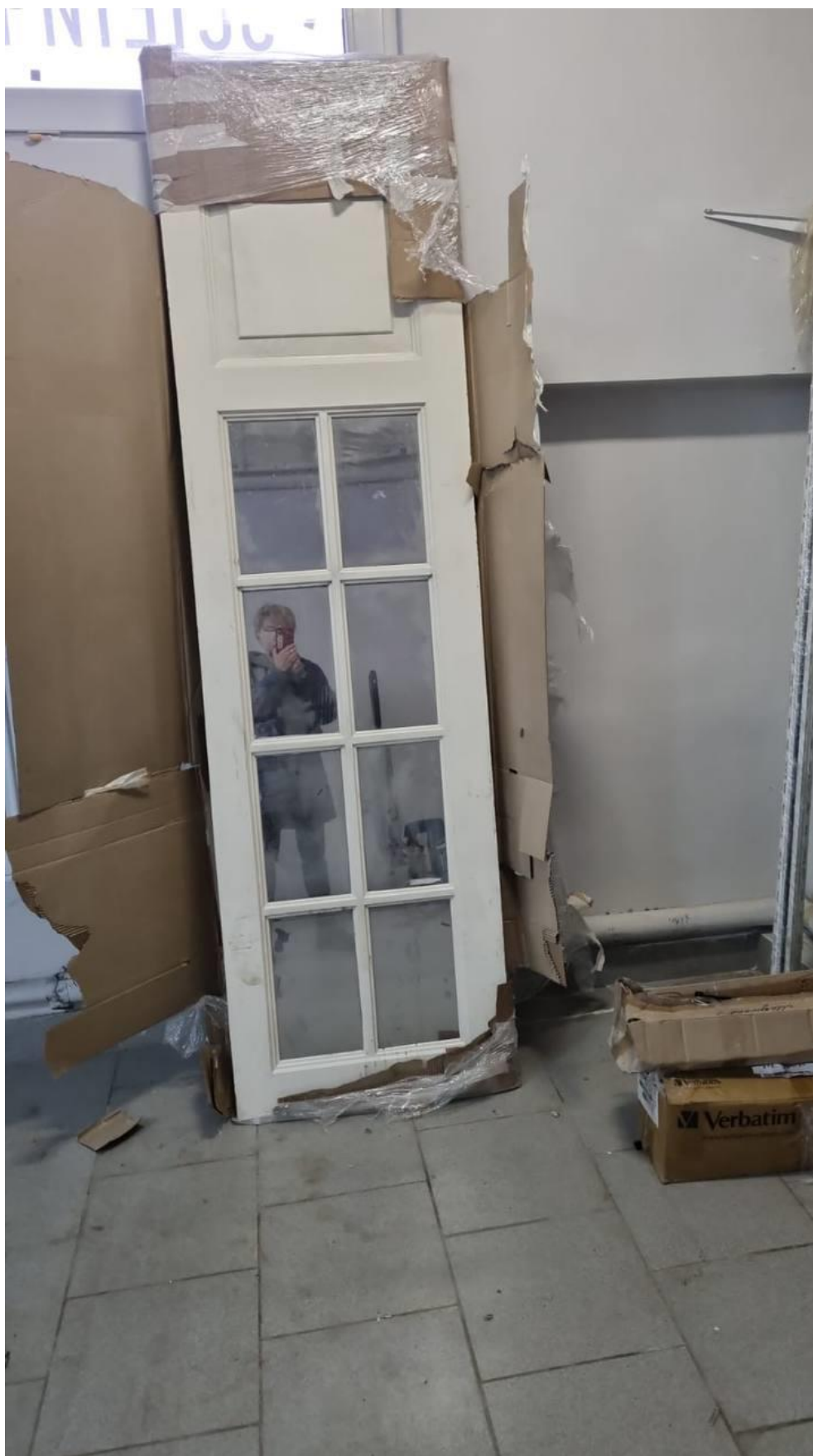
Илл. 67. Демонтированная дверь, до 2015 года была установлена в дверном проеме из помещения 40 пл. 3,6 кв. м в помещение 45 пл. 47,5 кв. м. 2024 г. (предоставлено собственником помещения 10-Н).
