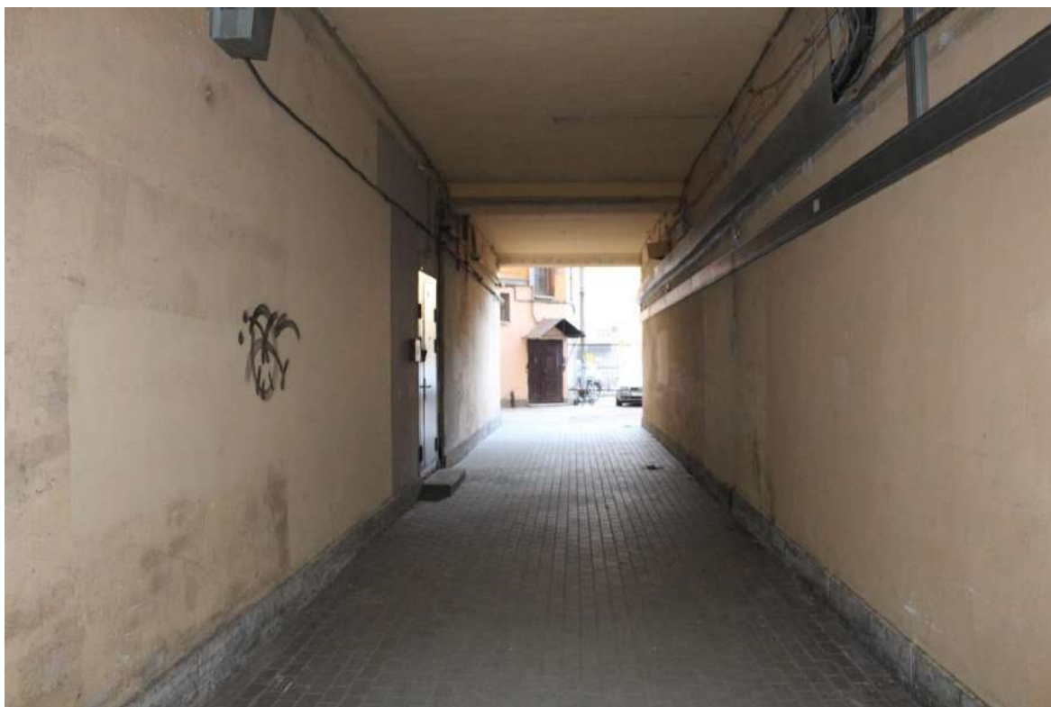
Фото 32. Вид на северо-западный воротный проезд северного корпуса выявленного объекта культурного наследия «Дом Второго Санкт-Петербургского товарищества для устройства постоянных квартир (с курдонером, палисадниками и оградой)».
