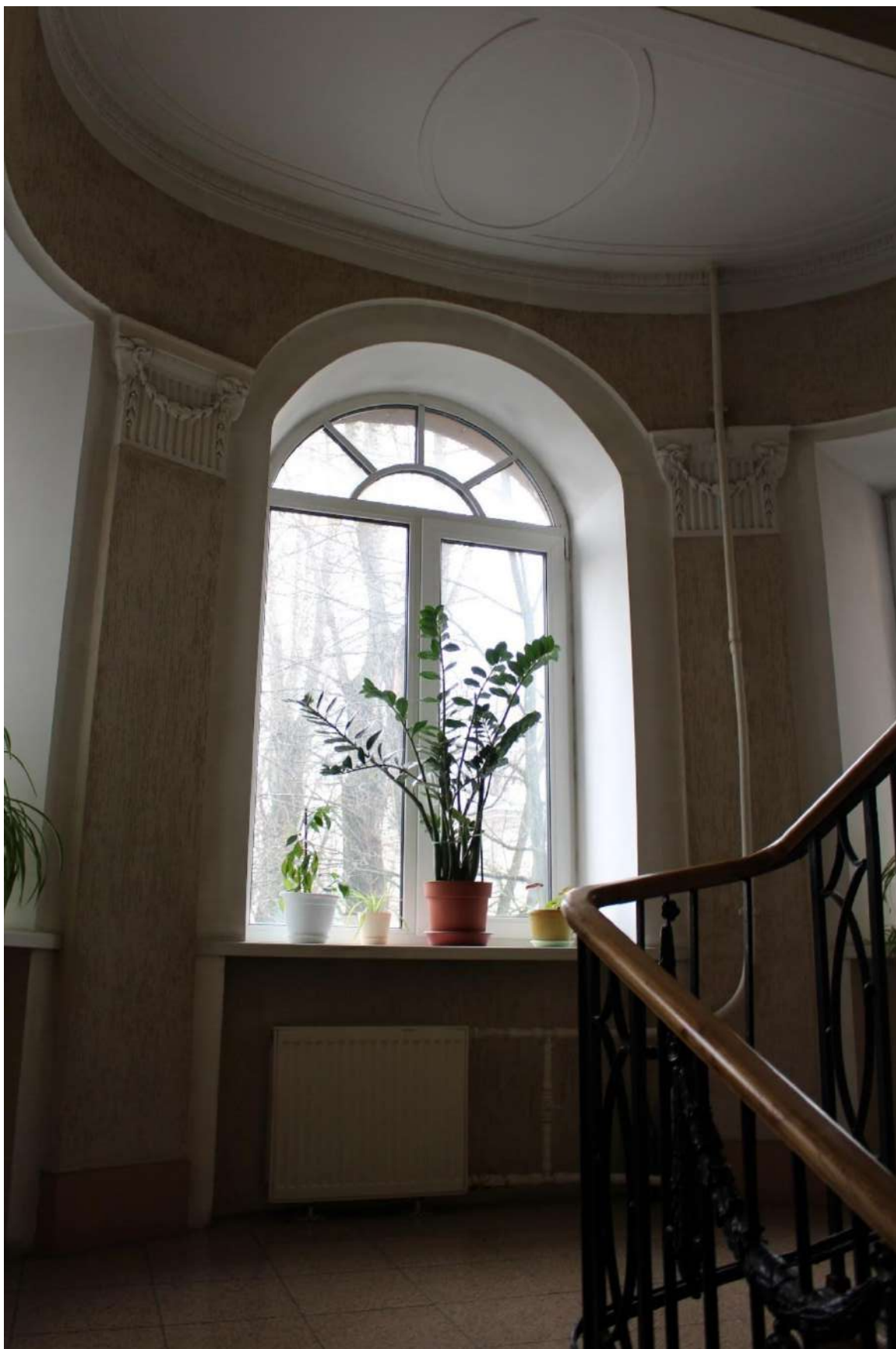
Фото 208. Выявленный объект культурного наследия «Дом Второго Санкт-Петербургского товарищества для устройства постоянных квартир (с курдонером, палисадниками и оградой)». Лестничная клетка 9ЛК в уровне 1-го - 2-го этажей.
