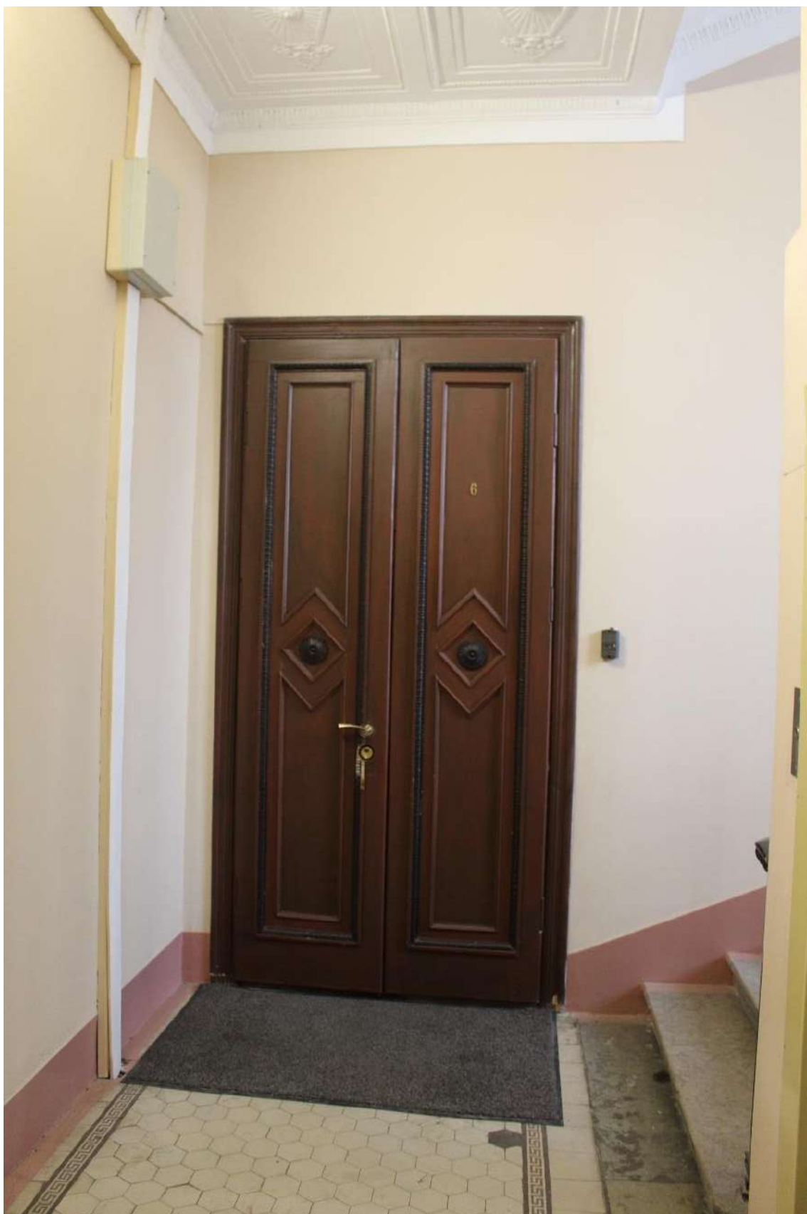
Фото 79. Выявленный объект культурного наследия «Дом Второго Санкт-Петербургского товарищества для устройства постоянных квартир (с курдонером, палисадниками и оградой)». Лестничная клетка 1ЛК в уровне 3-го этажа.
