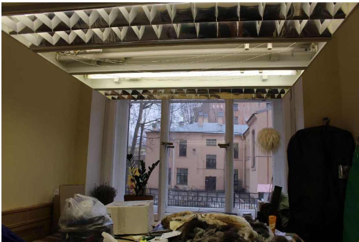
Фото 268. Выявленный объект культурного наследия «Дом Второго Санкт-Петербургского товарищества для устройства постоянных квартир (с курдонером, палисадниками и оградой)». Помещение 10-Н.
