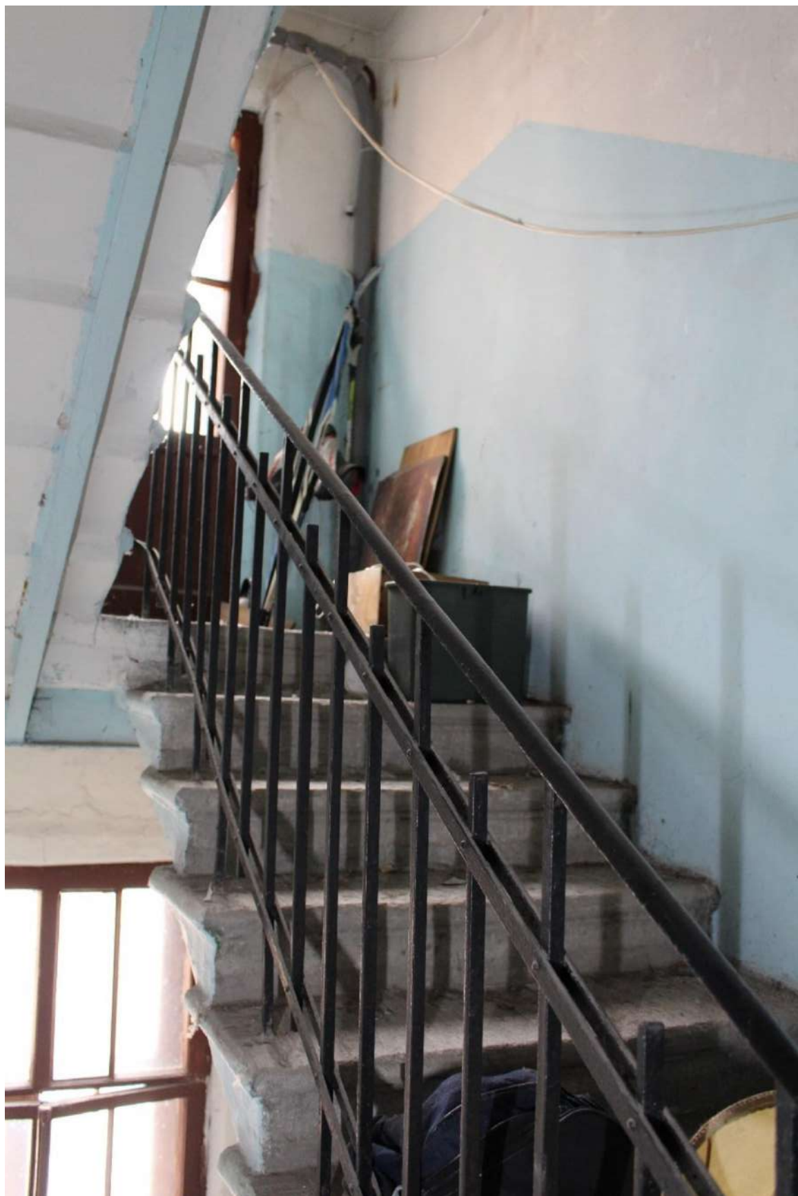
Фото 225. Выявленный объект культурного наследия «Дом Второго Санкт-Петербургского товарищества для устройства постоянных квартир (с курдонером, палисадниками и оградой)». Лестничная клетка 10ЛК в уровне 3-го этажа.
