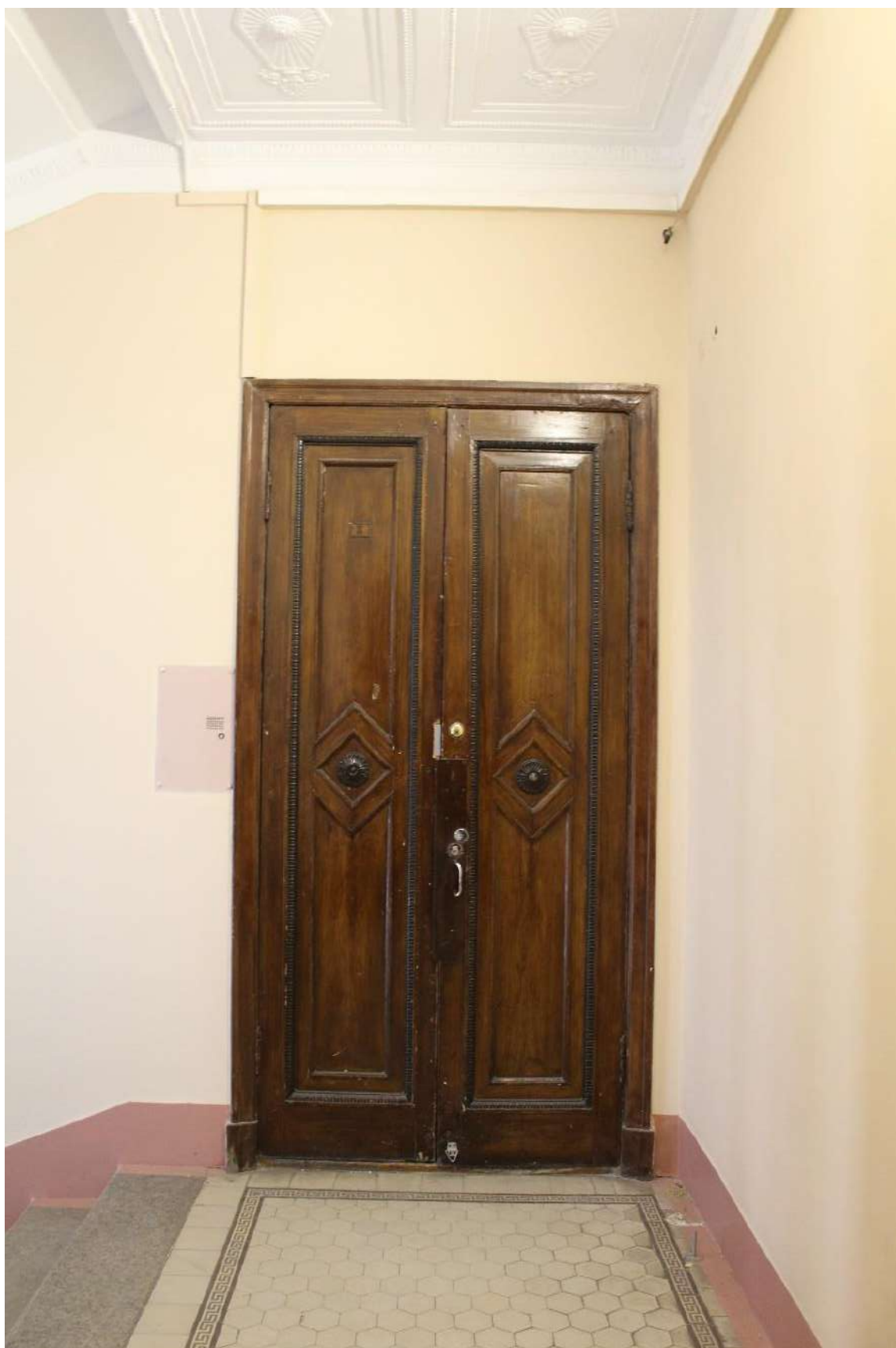
Фото 80. Выявленный объект культурного наследия «Дом Второго Санкт-Петербургского товарищества для устройства постоянных квартир (с курдонером, палисадниками и оградой)». Лестничная клетка 1ЛК в уровне 3-го этажа.
