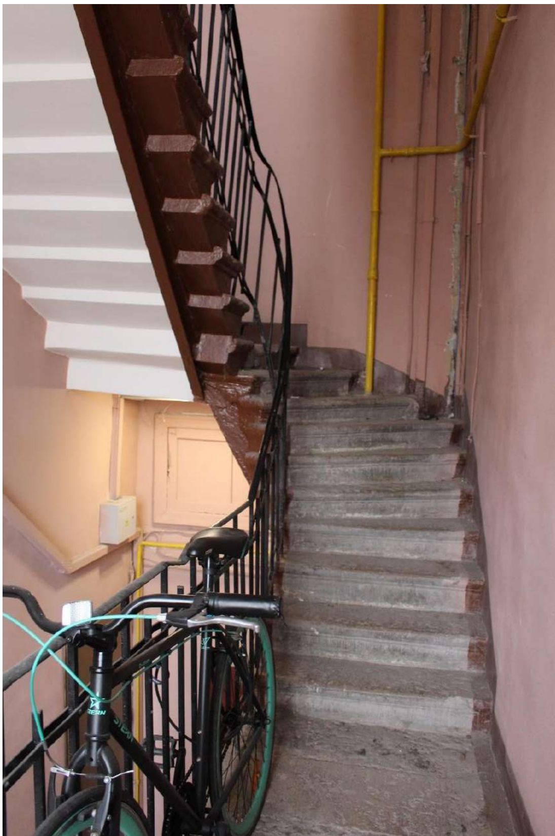
Фото 234. Выявленный объект культурного наследия «Дом Второго Санкт-Петербургского товарищества для устройства постоянных квартир (с курдонером, палисадниками и оградой)». Лестничная клетка 11ЛК в уровне 5-го этажа.
