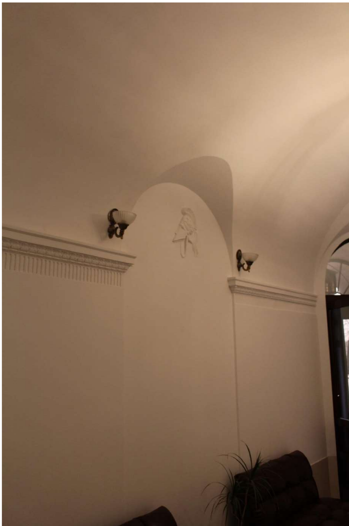
Фото 180. Выявленный объект культурного наследия «Дом Второго Санкт-Петербургского товарищества для устройства постоянных квартир (с курдонером, палисадниками и оградой)». Вестибюль 7ЛК.
