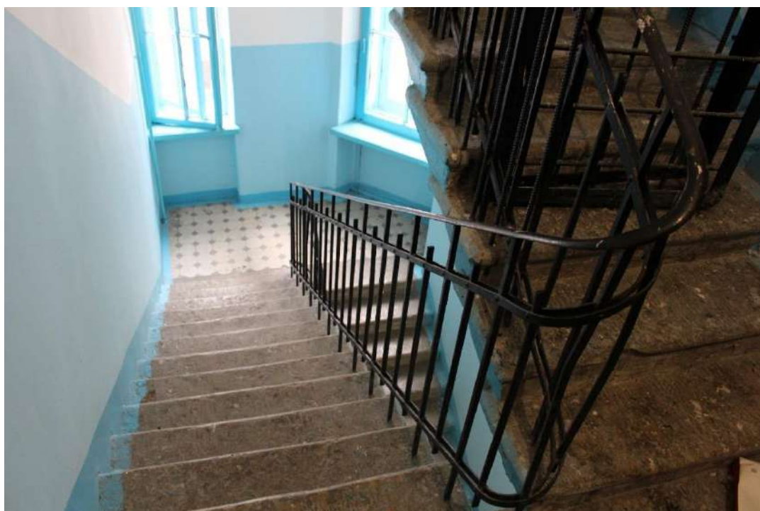
Фото 142. Выявленный объект культурного наследия «Дом Второго Санкт-Петербургского товарищества для устройства постоянных квартир (с курдонером, палисадниками и оградой)». Лестничная клетка ЗЛК в уровне 4-го – 5-го этажей.
