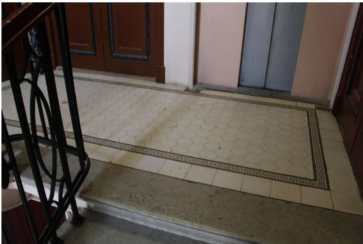
Фото 188. Выявленный объект культурного наследия «Дом Второго Санкт-Петербургского товарищества для устройства постоянных квартир (с курдонером, палисадниками и оградой)». Лестничная клетка 7ЛК в уровне 4-го этажа.
