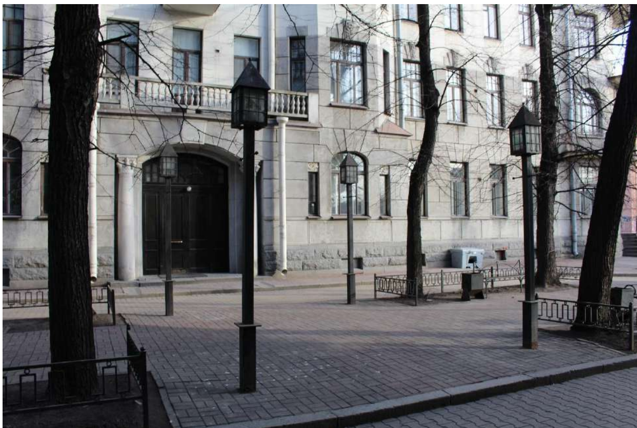
Фото 24. Вид на палисадник в центре курдонера выявленного объекта культурного наследия «Дом Второго Санкт-Петербургского товарищества для устройства постоянных квартир (с курдонером, палисадниками и оградой)».
