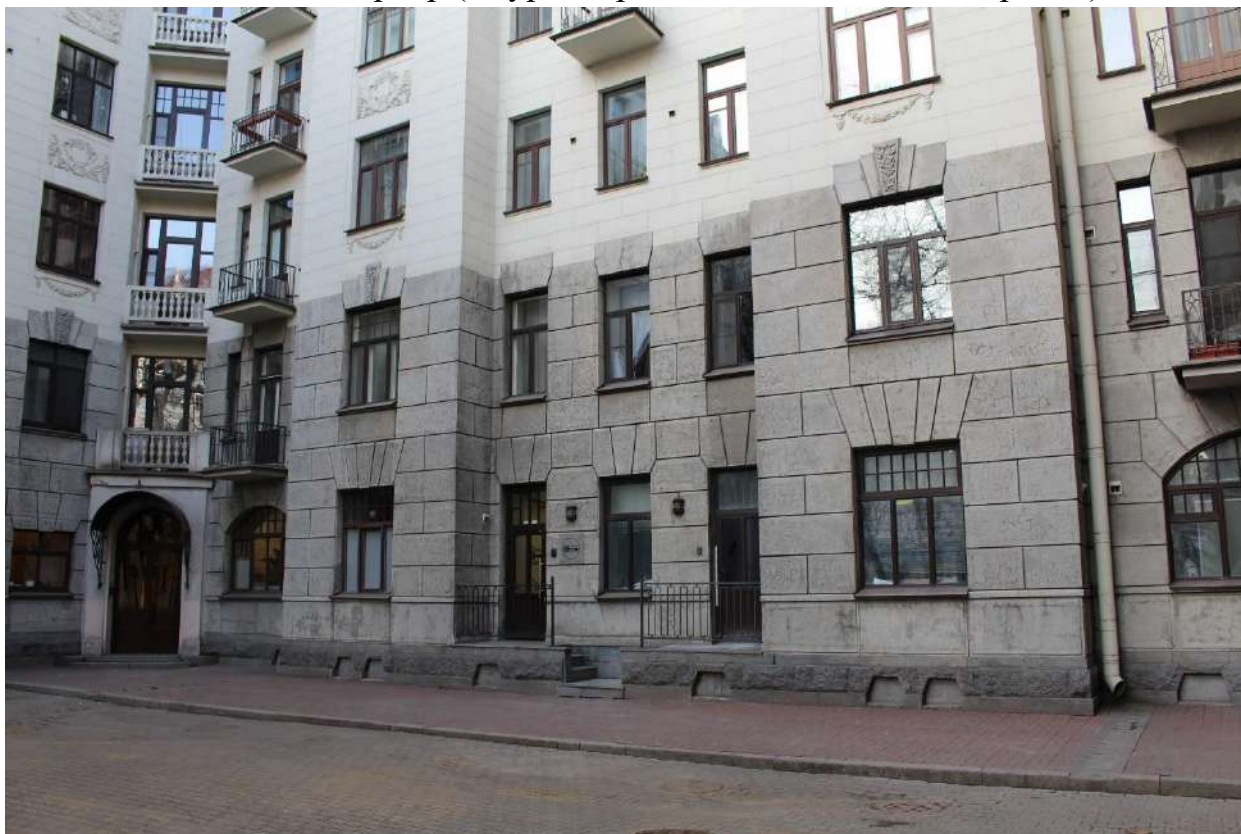
Фото 17. Вид лицевой фасад северного корпуса выявленного объекта культурного наследия «Дом Второго Санкт-Петербургского товарищества для устройства постоянных квартир (с курдонером, палисадниками и оградой)».
