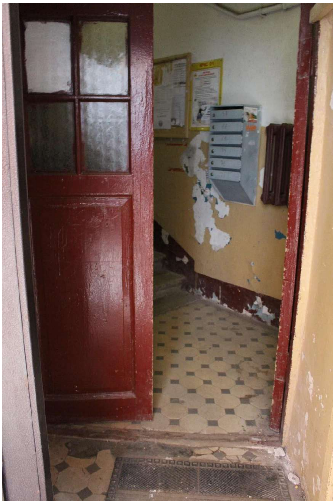
Фото 159. Выявленный объект культурного наследия «Дом Второго Санкт-Петербургского товарищества для устройства постоянных квартир (с курдонером, палисадниками и оградой)». Лестничная клетка БЛК в уровне 1-го этажа.
