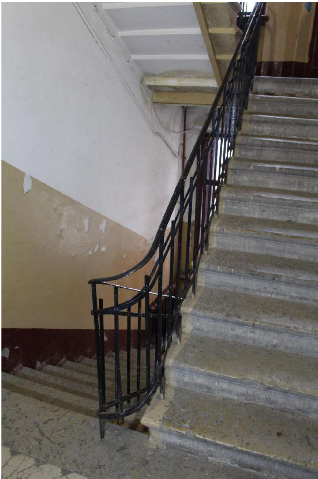
Фото 167. Выявленный объект культурного наследия «Дом Второго Санкт-Петербургского товарищества для устройства постоянных квартир (с курдонером, палисадниками и оградой)». Лестничная клетка БЛК в уровне 2-го этажа.
