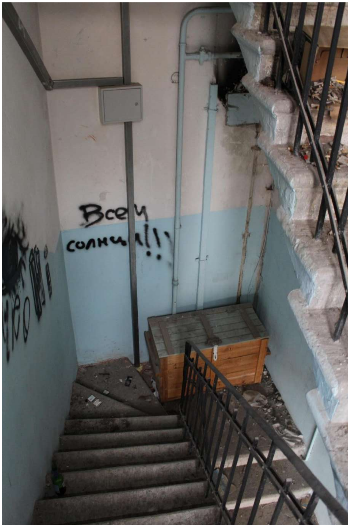
Фото 224. Выявленный объект культурного наследия «Дом Второго Санкт-Петербургского товарищества для устройства постоянных квартир (с курдонером, палисадниками и оградой)». Лестничная клетка 10ЛК в уровне 2-го этажа.
