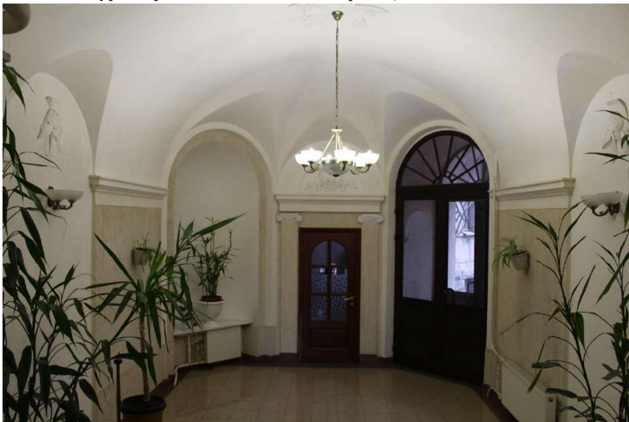
Фото 206. Выявленный объект культурного наследия «Дом Второго Санкт-Петербургского товарищества для устройства постоянных квартир (с курдонером, палисадниками и оградой)». Вестибюль 9ЛК.
