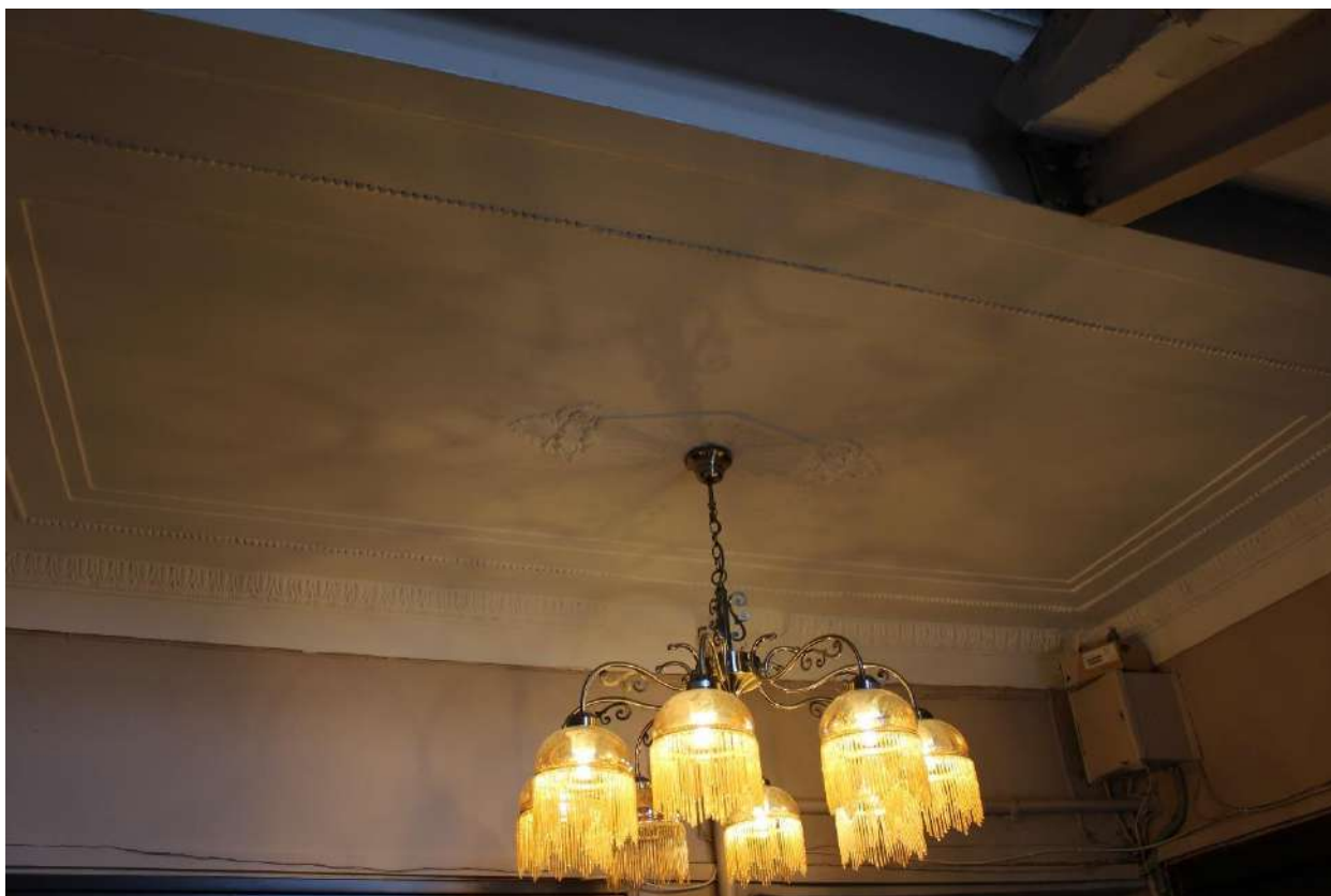
Фото 190. Выявленный объект культурного наследия «Дом Второго Санкт-Петербургского товарищества для устройства постоянных квартир (с курдонером, палисадниками и оградой)». Лестничная клетка 7ЛК в уровне 5-го этажа.
