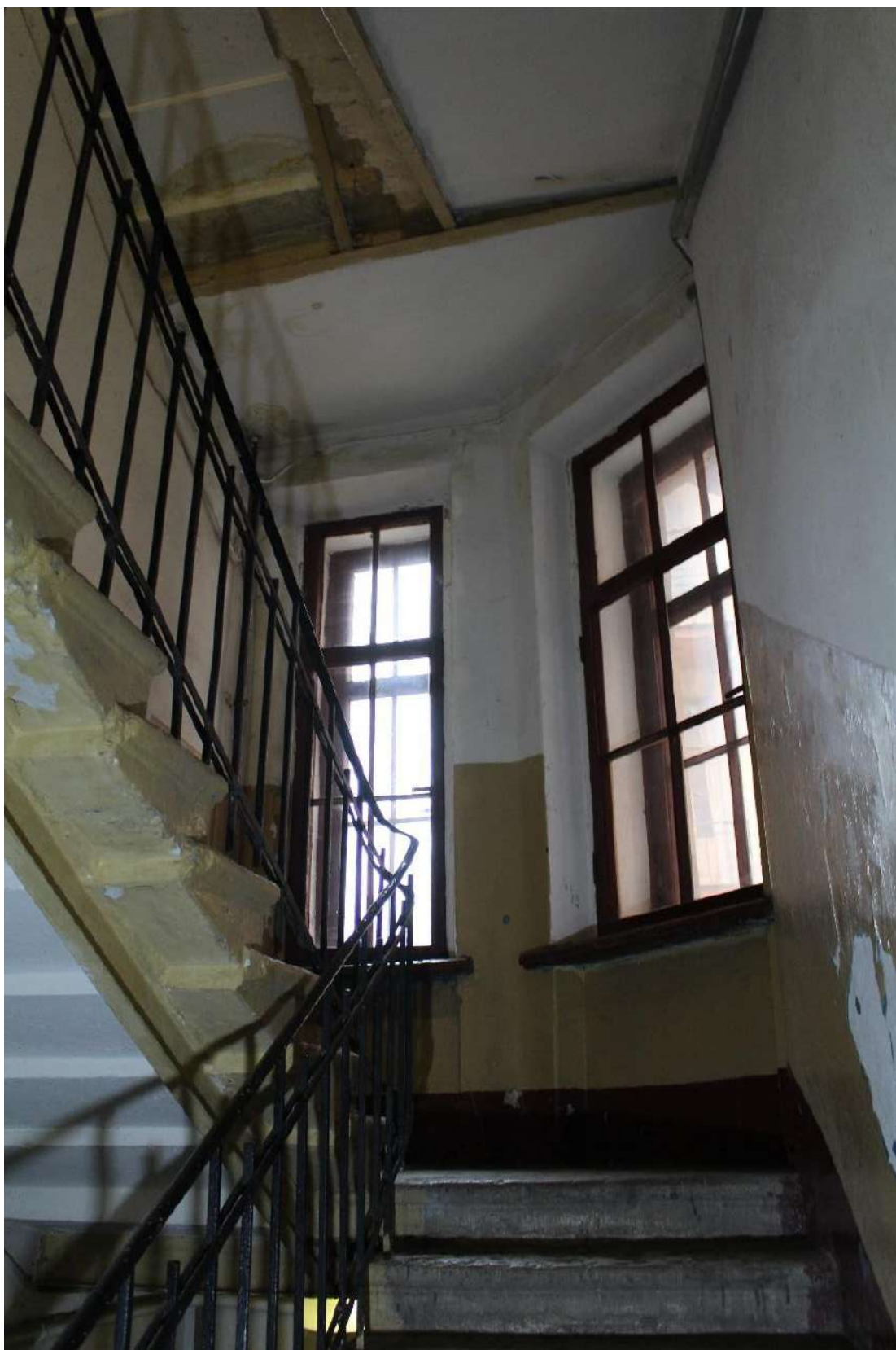
Фото 164. Выявленный объект культурного наследия «Дом Второго Санкт-Петербургского товарищества для устройства постоянных квартир (с курдонером, палисадниками и оградой)». Лестничная клетка бЛК в уровне 1-го – 2-го этажей.
