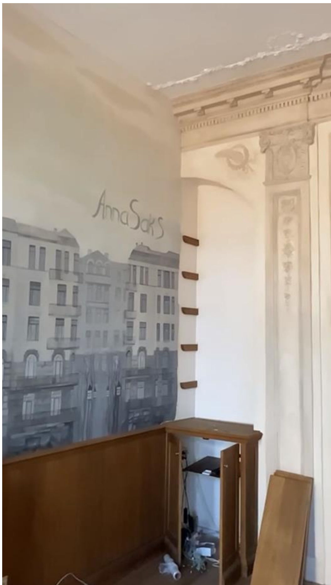
Илл. 62. Помещение 10-Н. Вид на ч.п. 5 пл. 26,8 кв. м. 31.08.2021 г. (предоставлено собственником помещения 10-Н).
