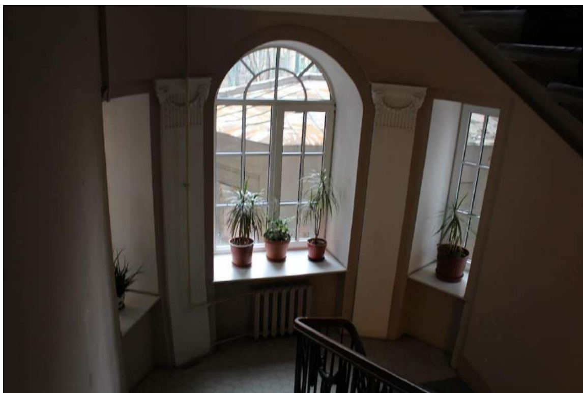
Фото 182. Выявленный объект культурного наследия «Дом Второго Санкт-Петербургского товарищества для устройства постоянных квартир (с курдонером, палисадниками и оградой)». Лестничная клетка 7ЛК в уровне 1-го – 2-го этажей.
