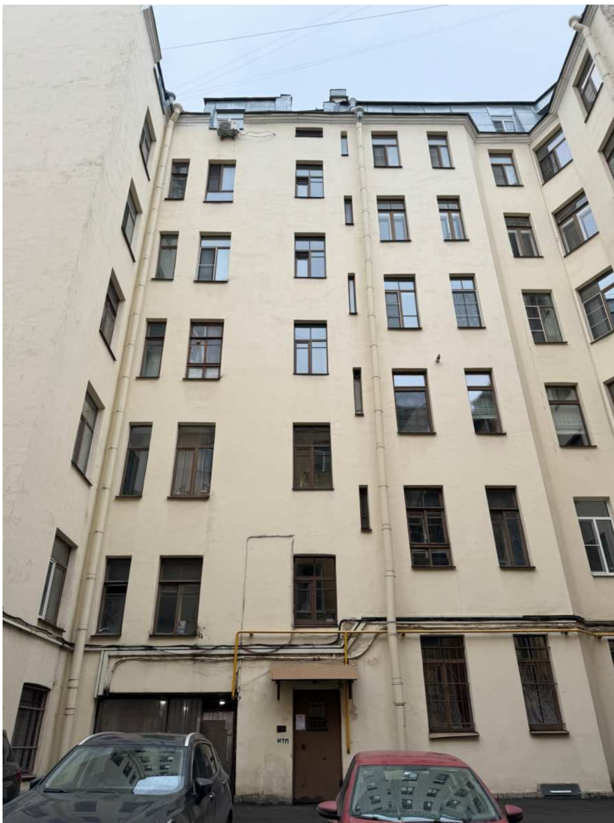
17. Дворовые фасады южного корпуса объекта культурного наследия.
