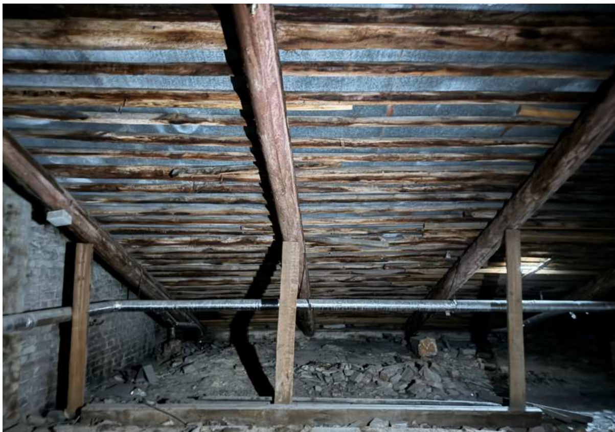
150. Общий вид чердачного помещения в части лестницы 5ЛК объекта культурного наследия.
