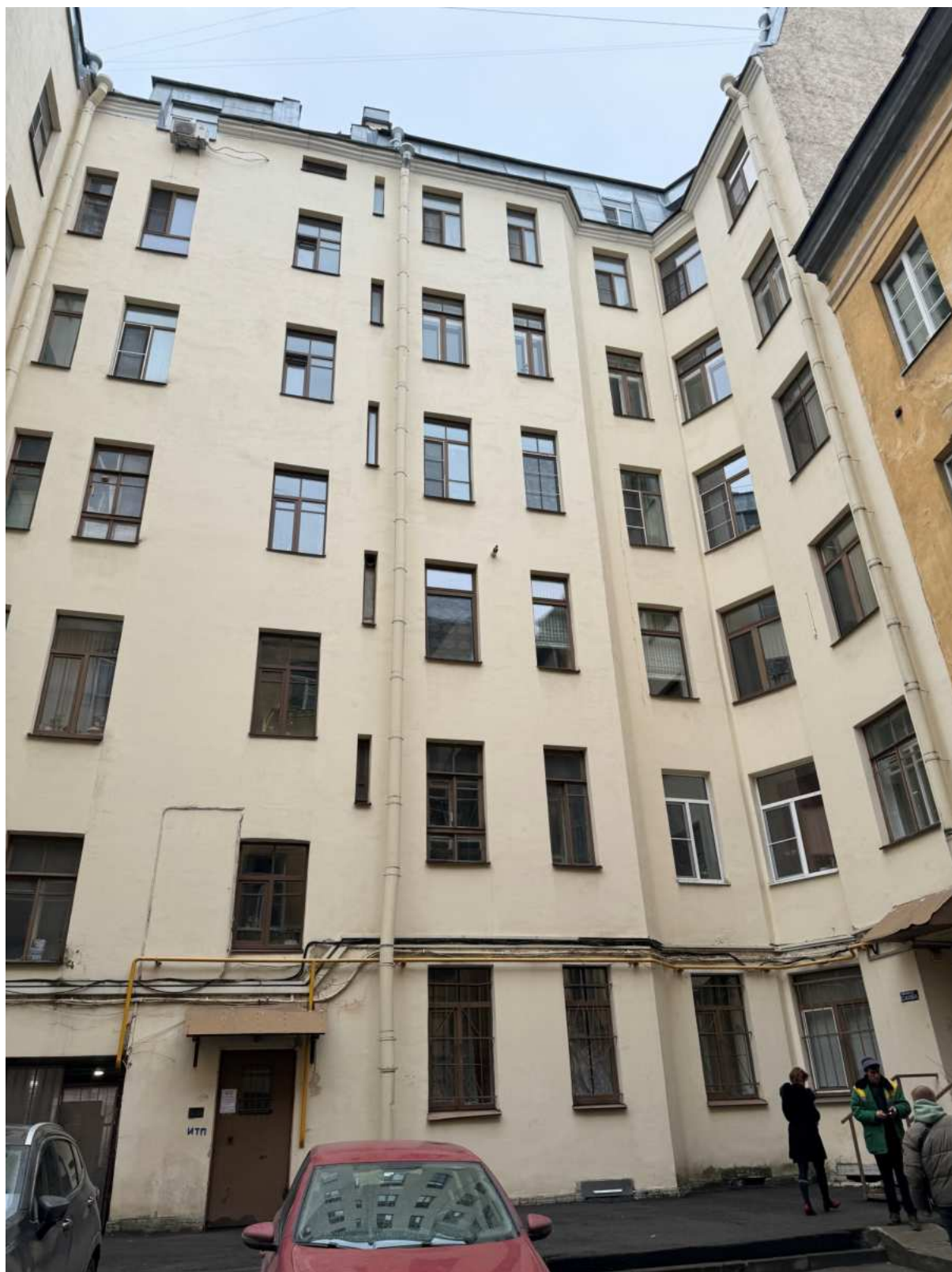
18. Дворовые фасады южного корпуса объекта культурного наследия.
