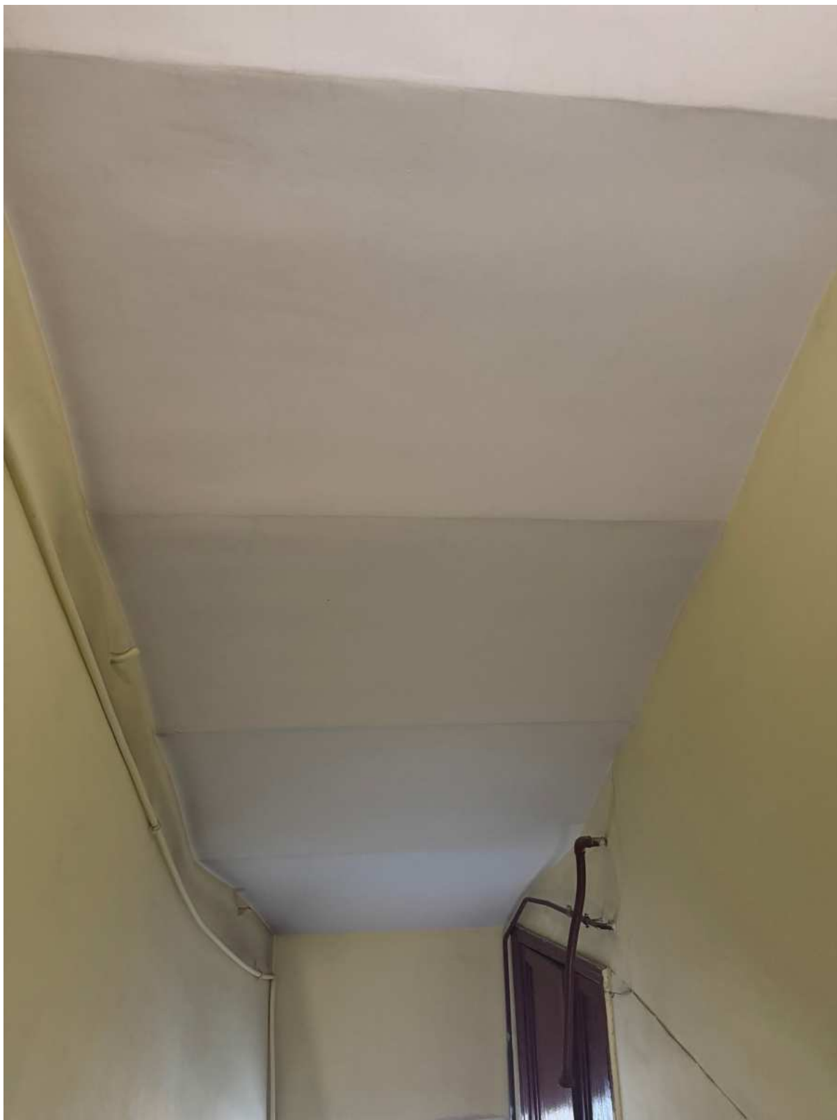
116. Верхнее перекрытие лестницы 4ЛК объекта культурного наследия.
