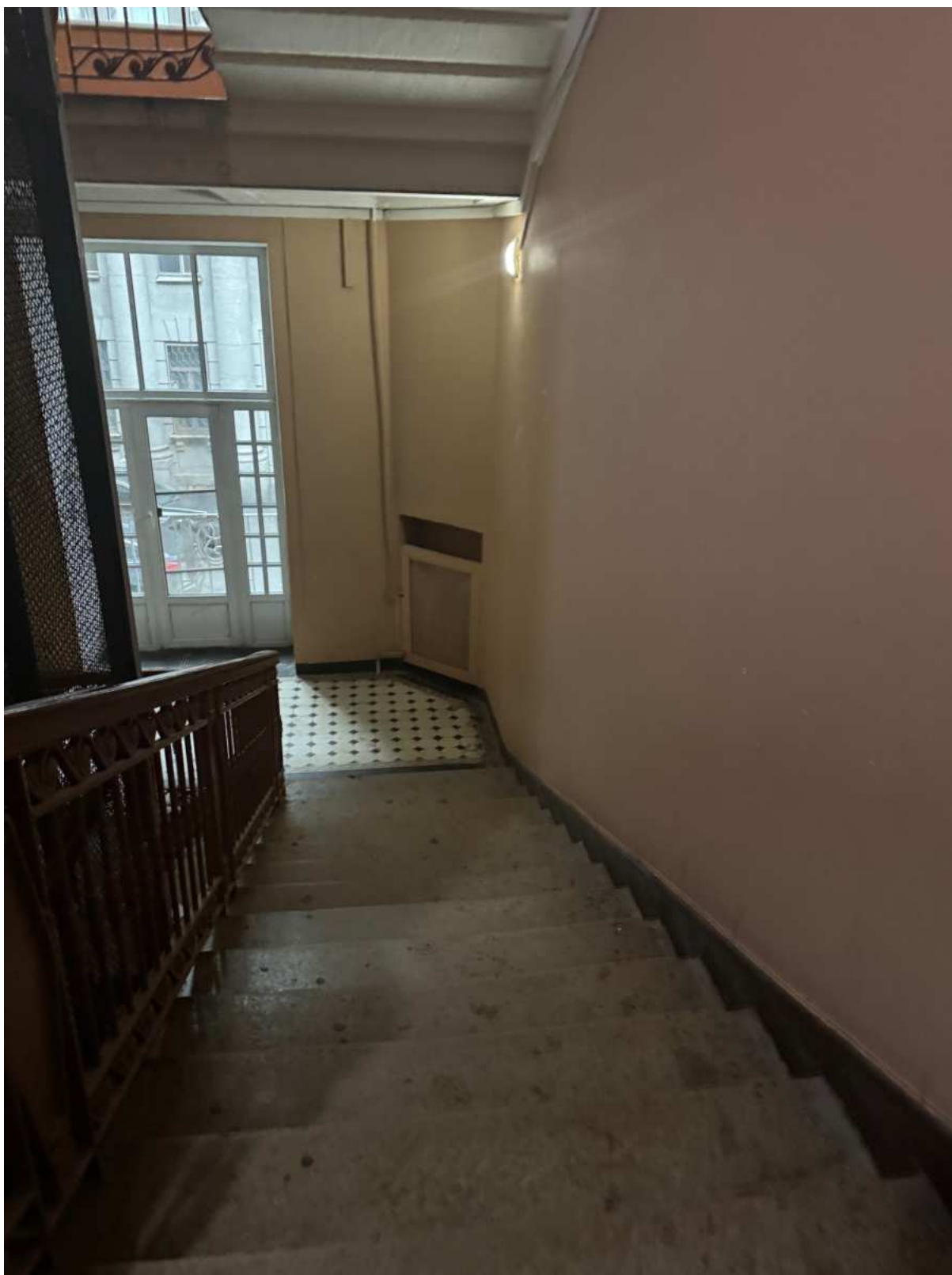
30. Общий вид лестницы 1ЛК объекта культурного наследия.
