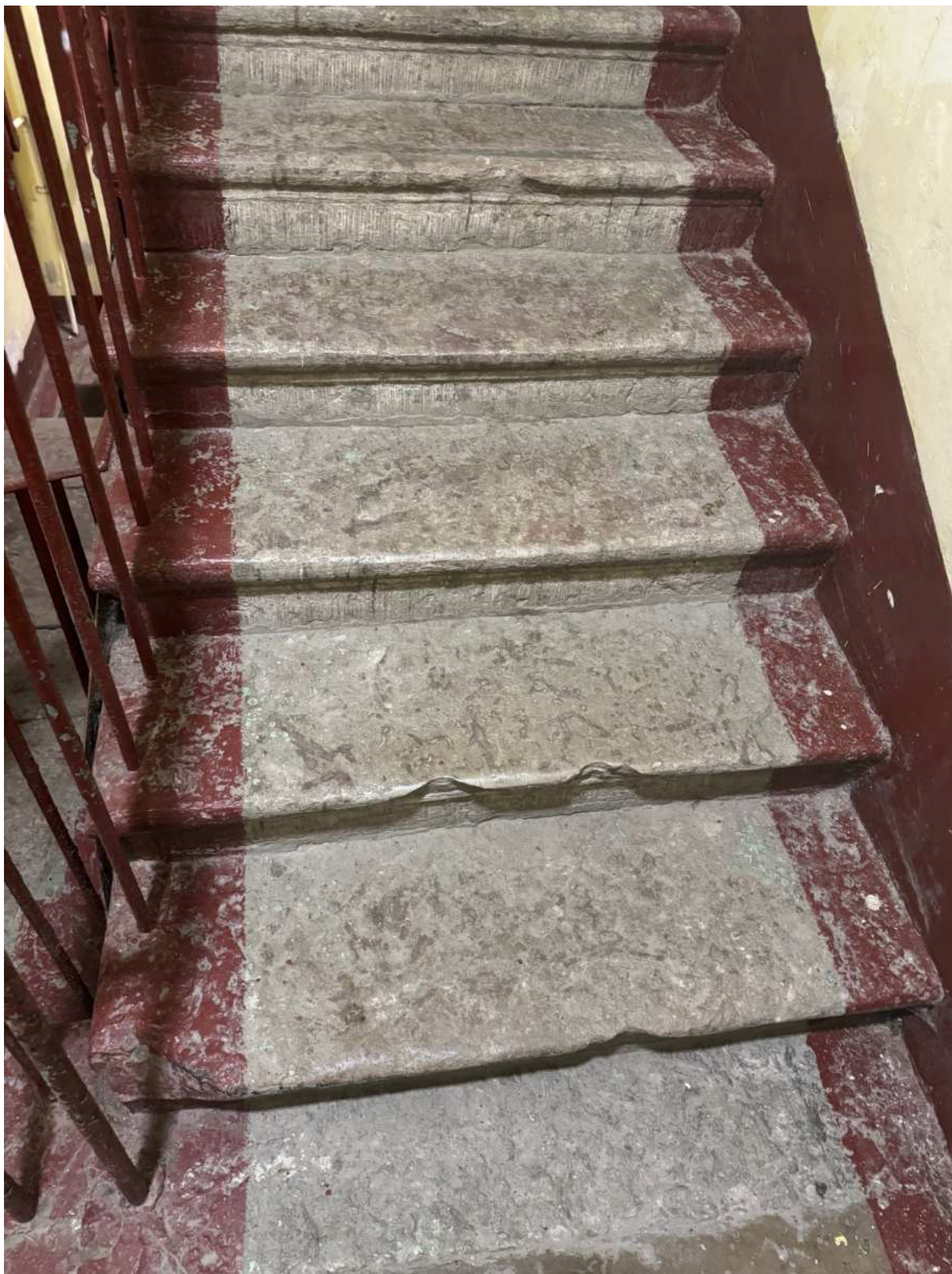
101. Ступени лестницы 4ЛК объекта культурного наследия.
