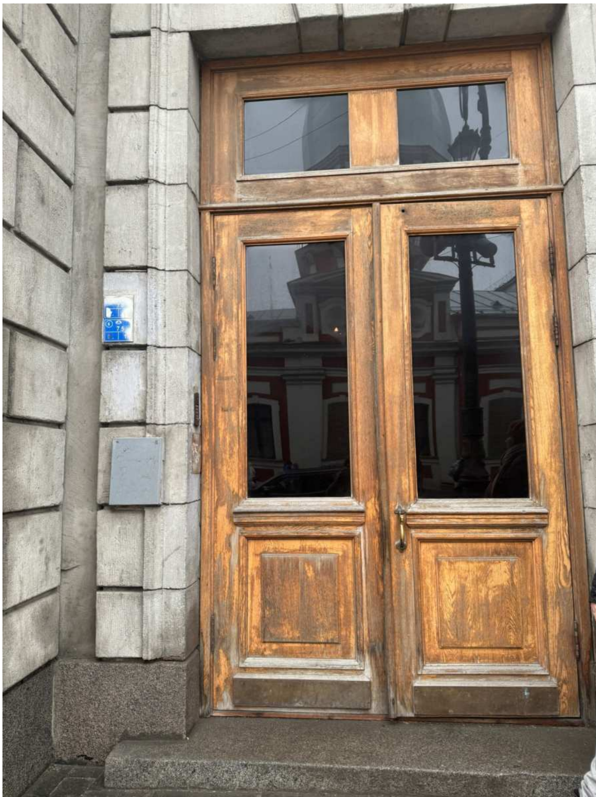
19. Вход в парадную лестницу 1ЛК с лицевого фасада объекта культурного наследия по улице Пестеля.
