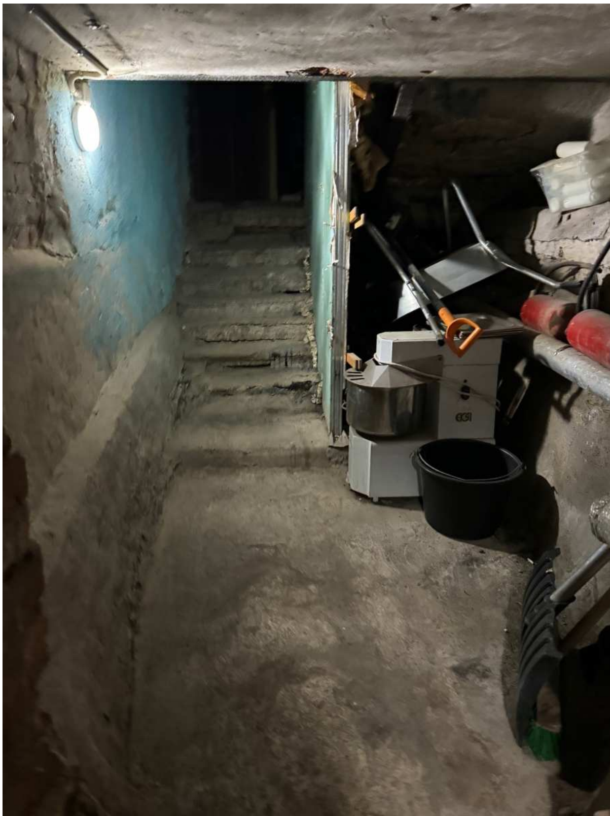
131. Общий вид подвального помещения в части лестницы 5ЛК объекта культурного наследия.
