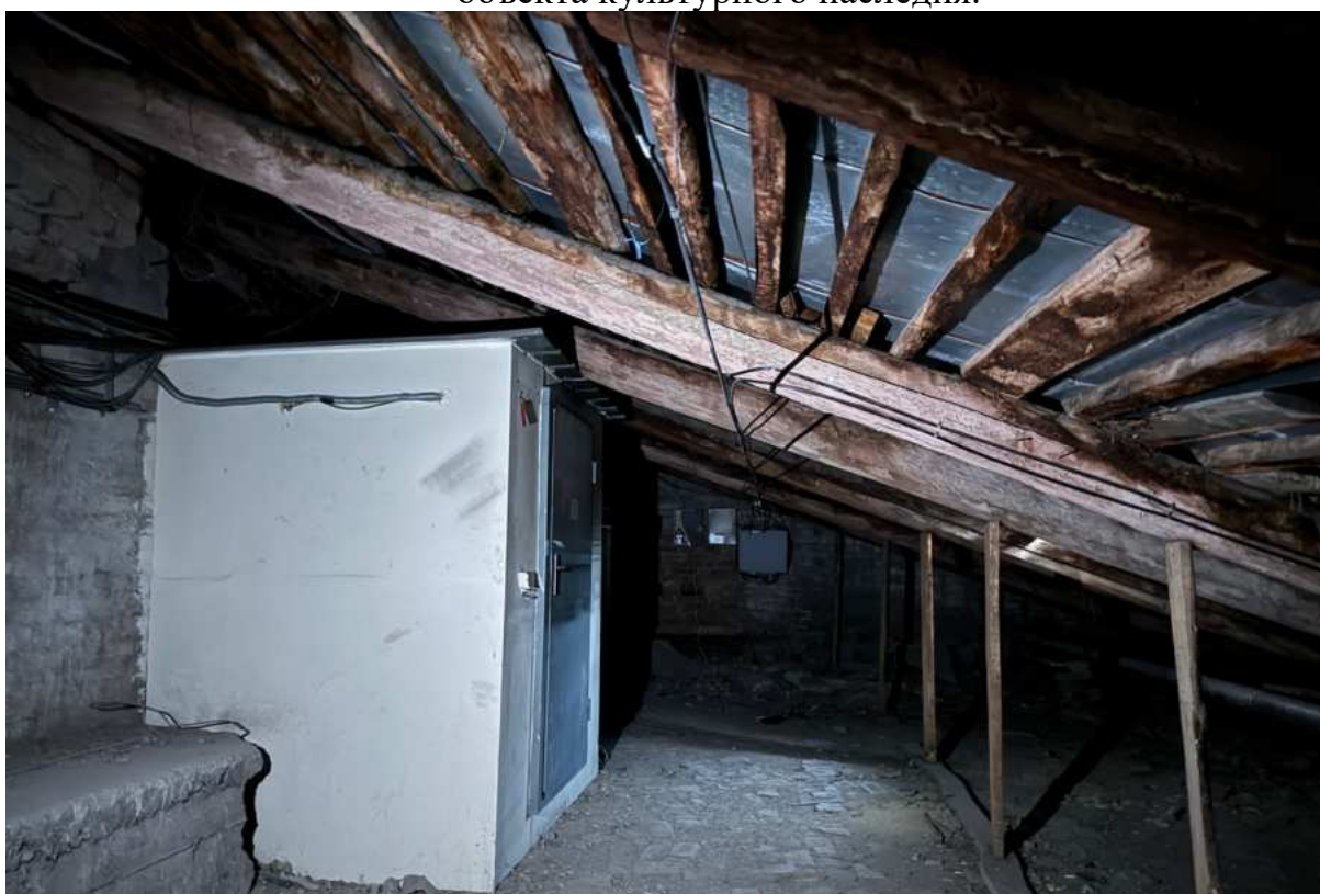
151. Общий вид чердачного помещения в части лестницы 5ЛК объекта культурного наследия.
