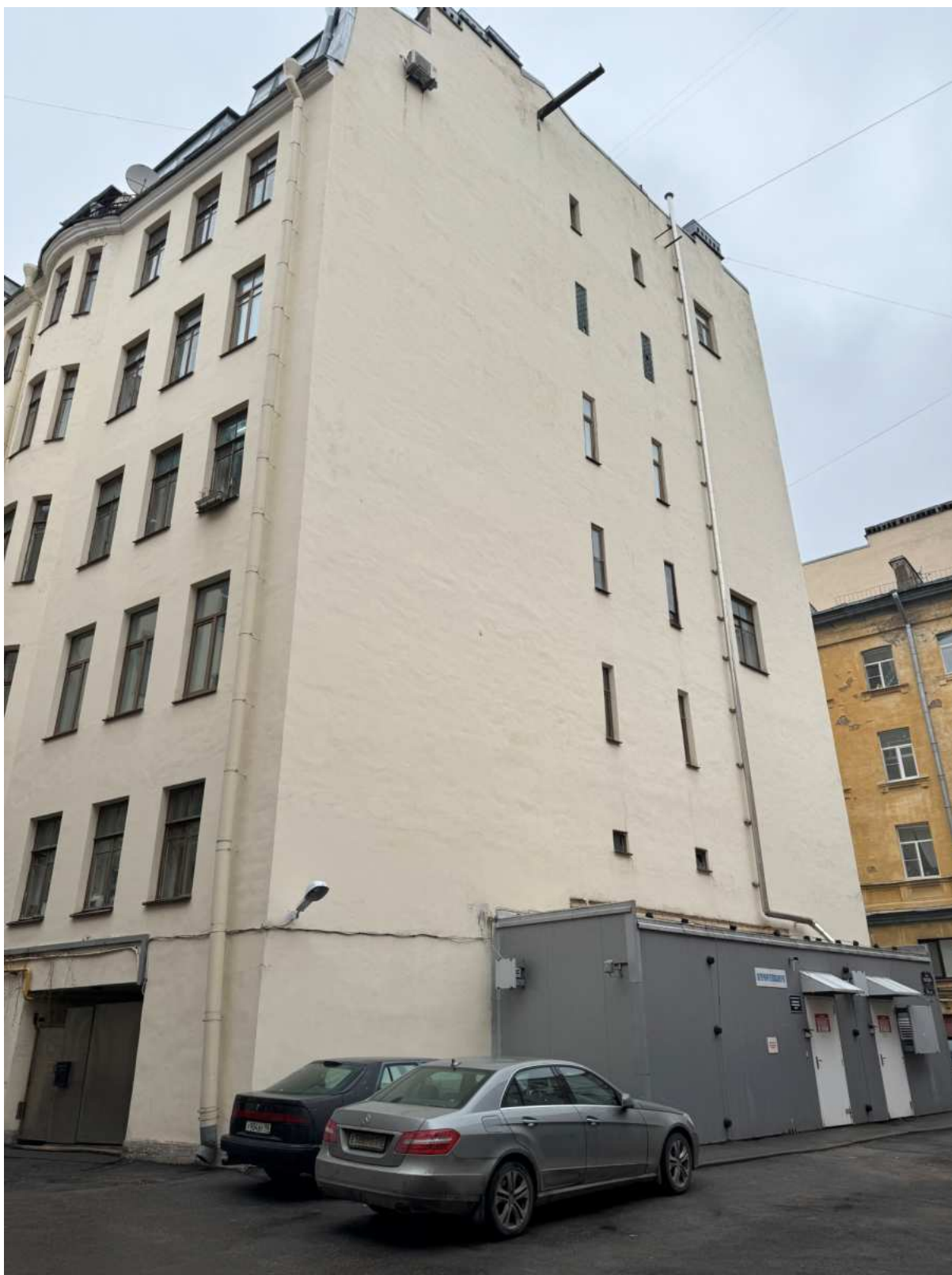
13. Дворовые фасады южного корпуса объекта культурного наследия.
