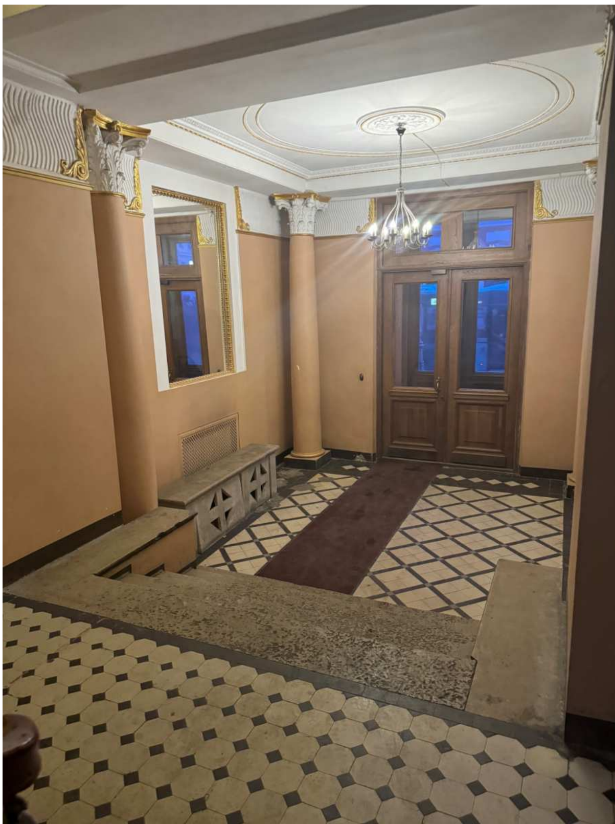
23. Общий вид вестибюля лестницы 1ЛК объекта культурного наследия.
