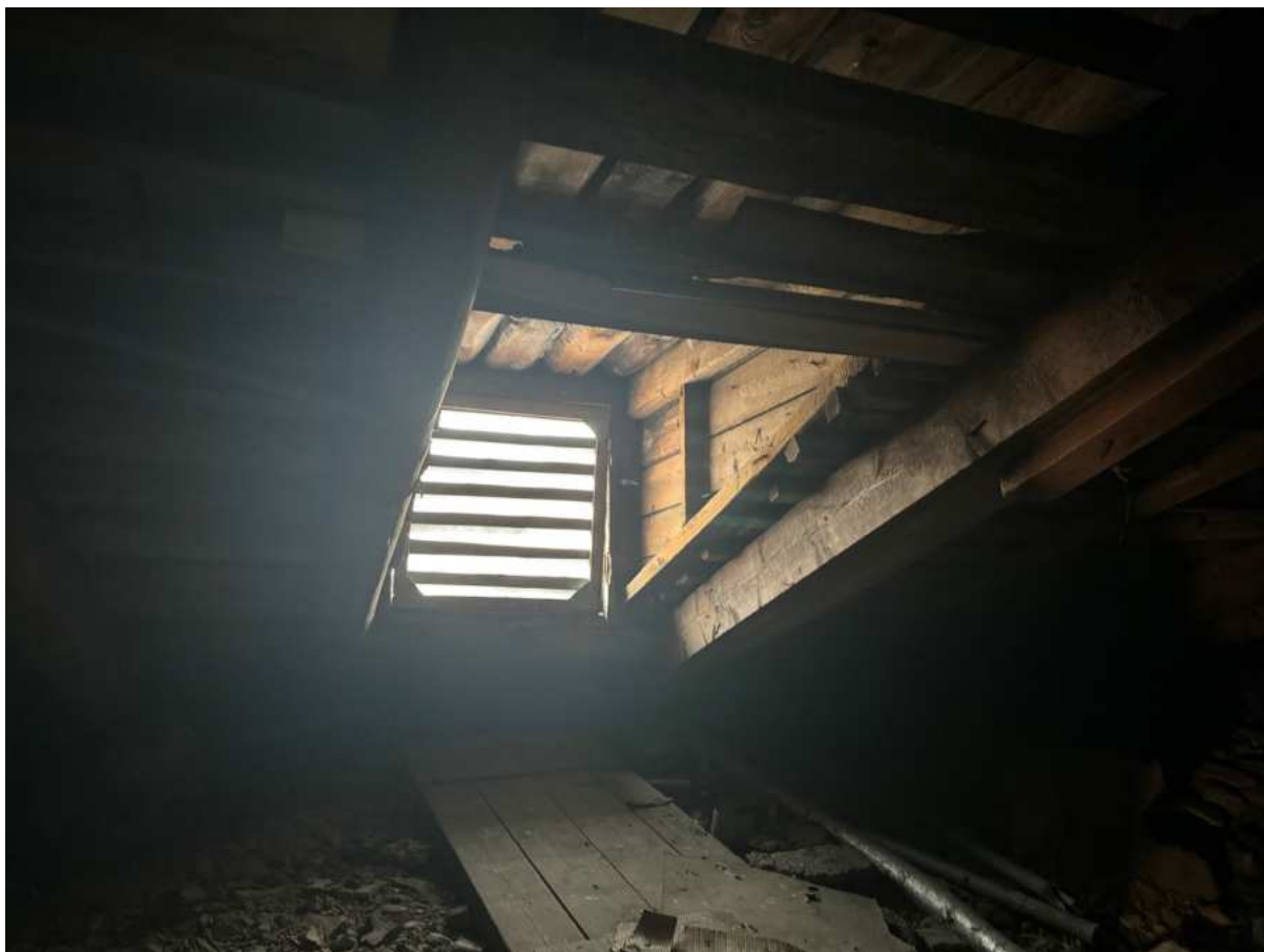
118. Общий вид чердачного помещения в части лестницы 4ЛК объекта культурного наследия.
