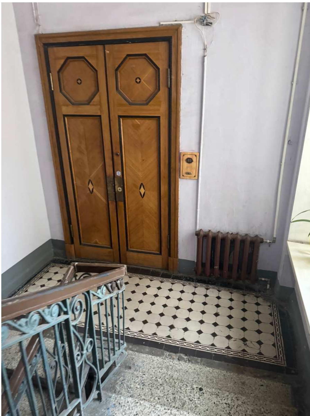
60. Общий вид лестницы 2ЛК объекта культурного наследия.
