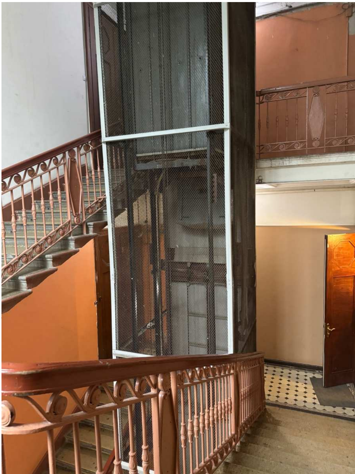
41.Общий вид лестницы 1ЛК объекта культурного наследия.
