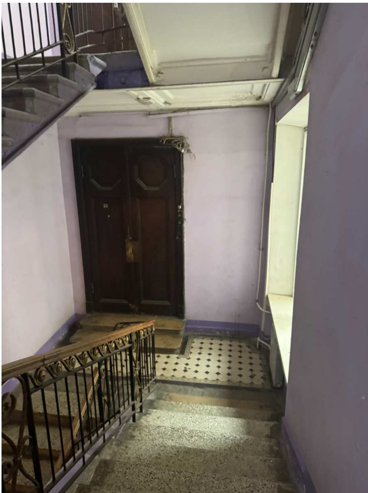
54. Общий вид лестницы 2ЛК объекта культурного наследия.
