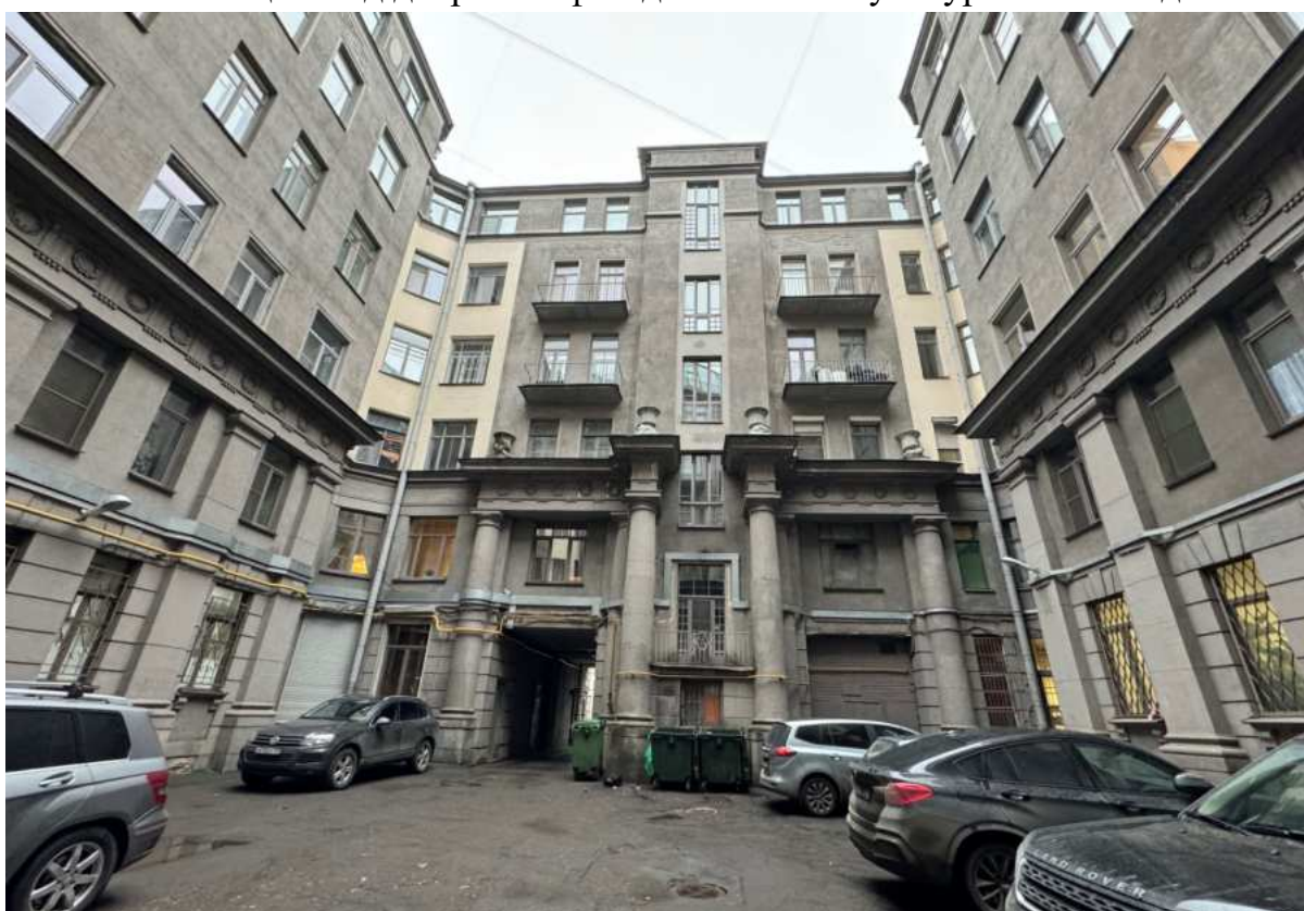
8. Общий вид дворовых фасадов объекта культурного наследия.
