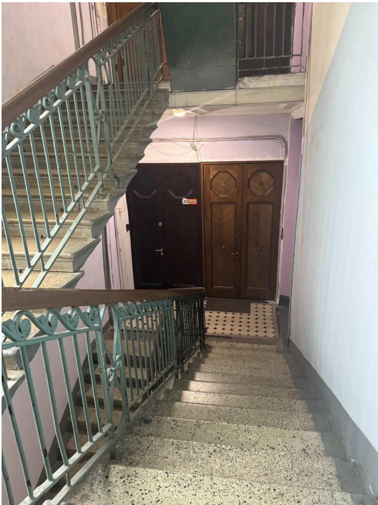
63. Общий вид лестницы 2ЛК объекта культурного наследия.
