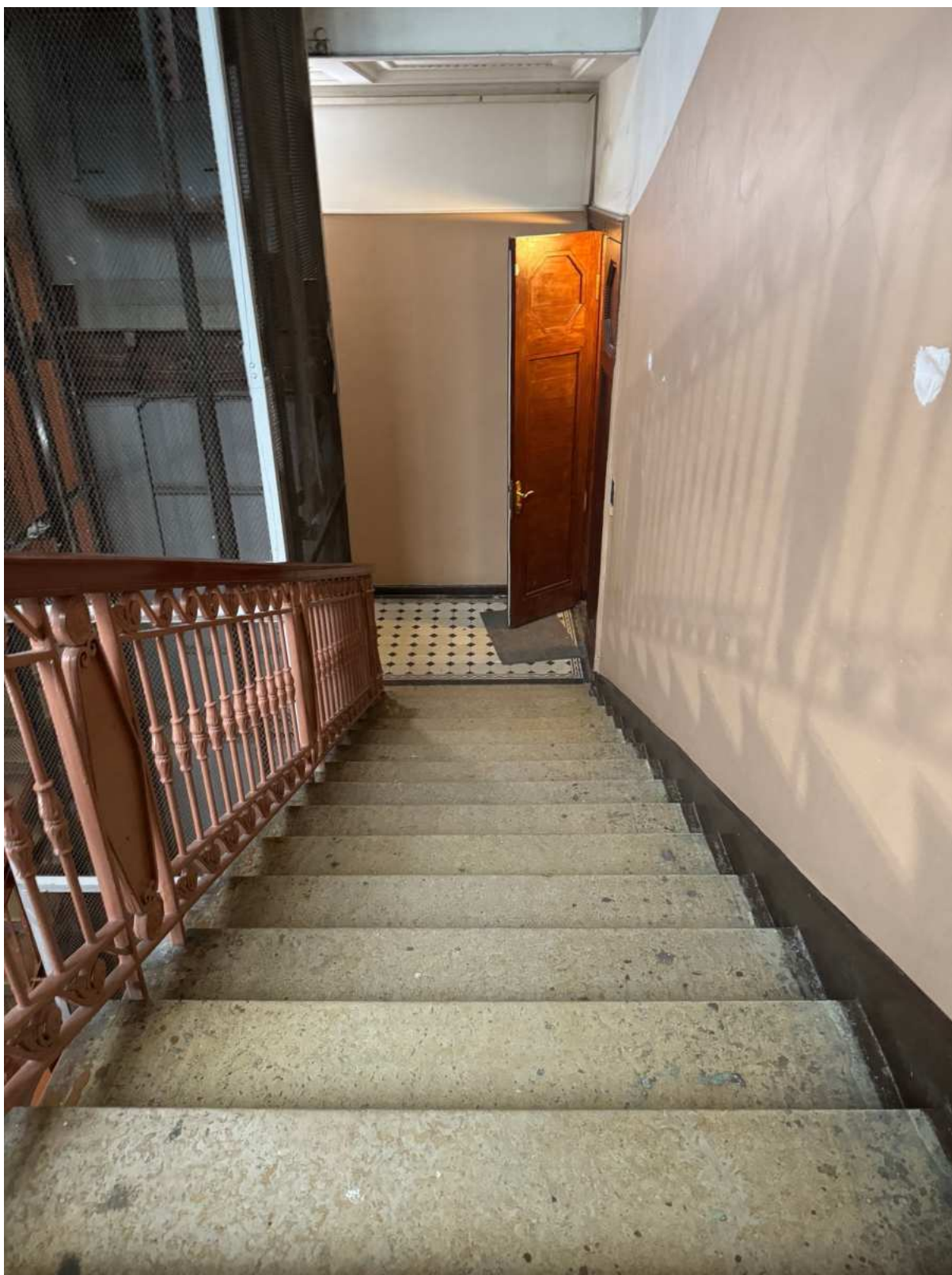
42. Общий вид лестницы 1ЛК объекта культурного наследия.
