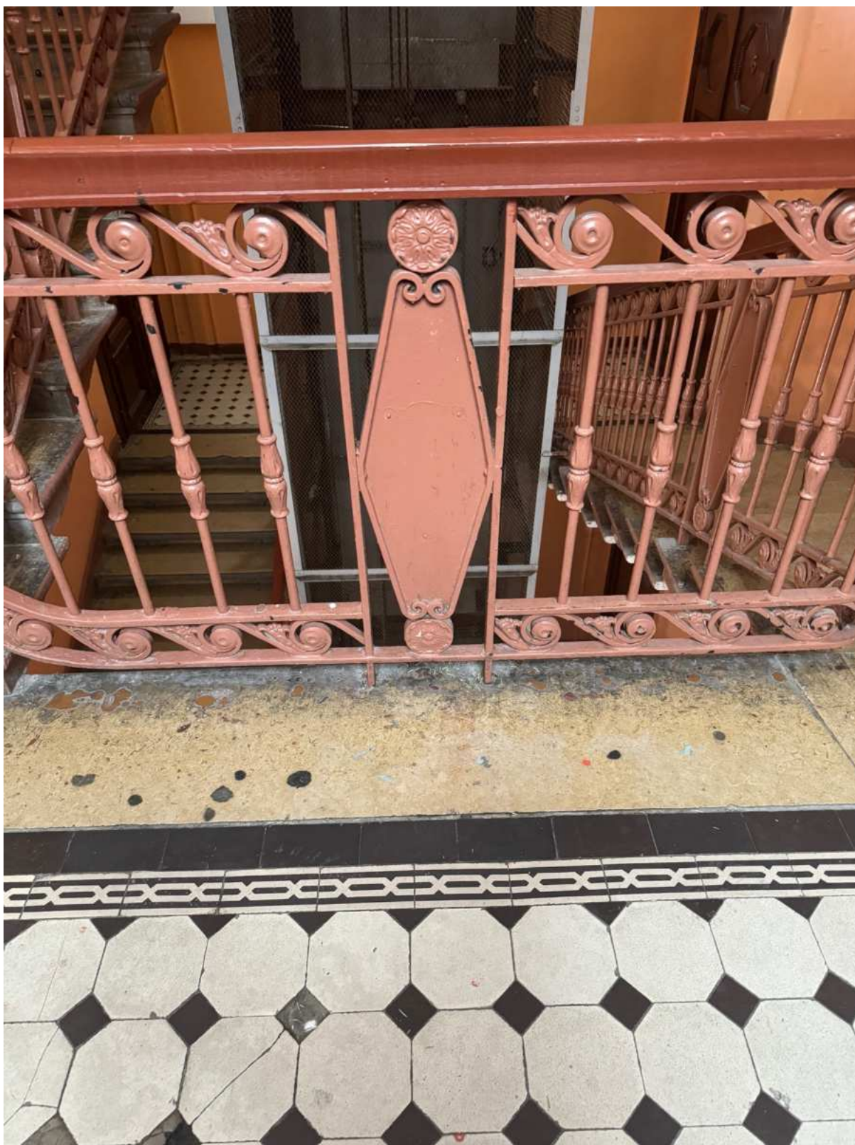
38. Общий вид лестницы 1ЛК объекта культурного наследия.
