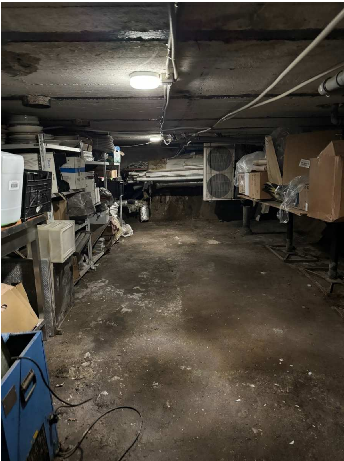
134. Общий вид подвального помещения в части лестницы 5ЛК объекта культурного наследия.
