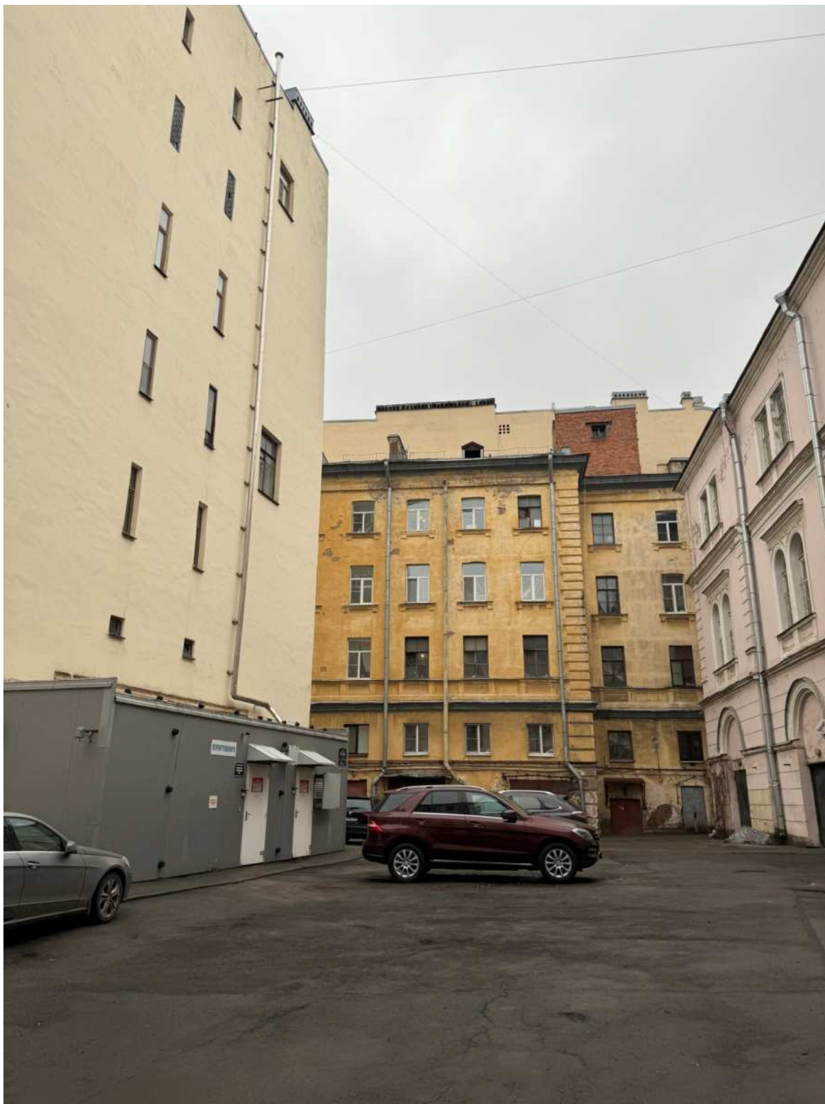
14. Дворовой фасад и двор южного корпуса объекта культурного наследия.
