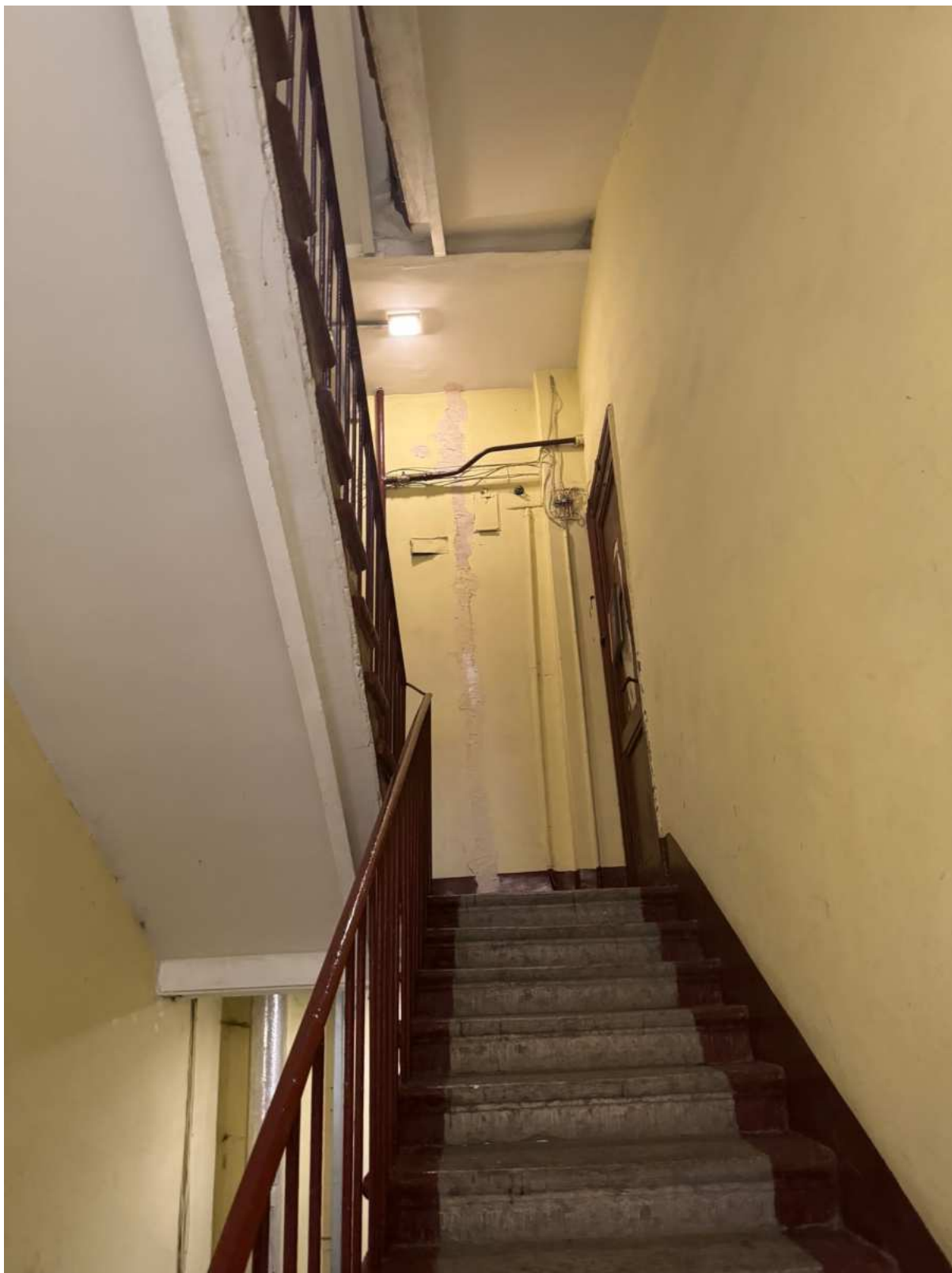
104. Общий вид лестницы 4ЛК объекта культурного наследия.
