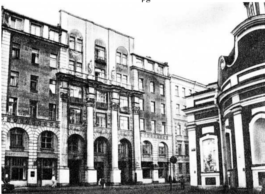
78. Ул. Пестеля, д. 7. Фасад здания. Фото 1990-х годов. (из книги «Улица Пестеля (Пантелеймоновская)») [Электронный ресурс]
