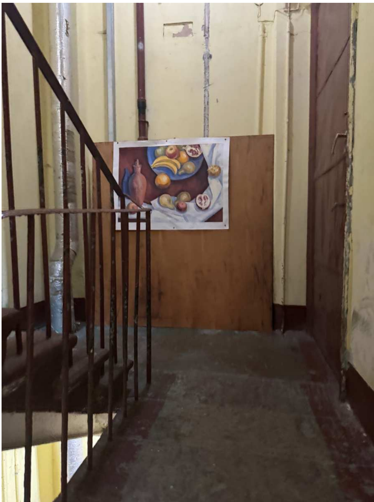
103. Общий вид лестницы 4ЛК объекта культурного наследия.
