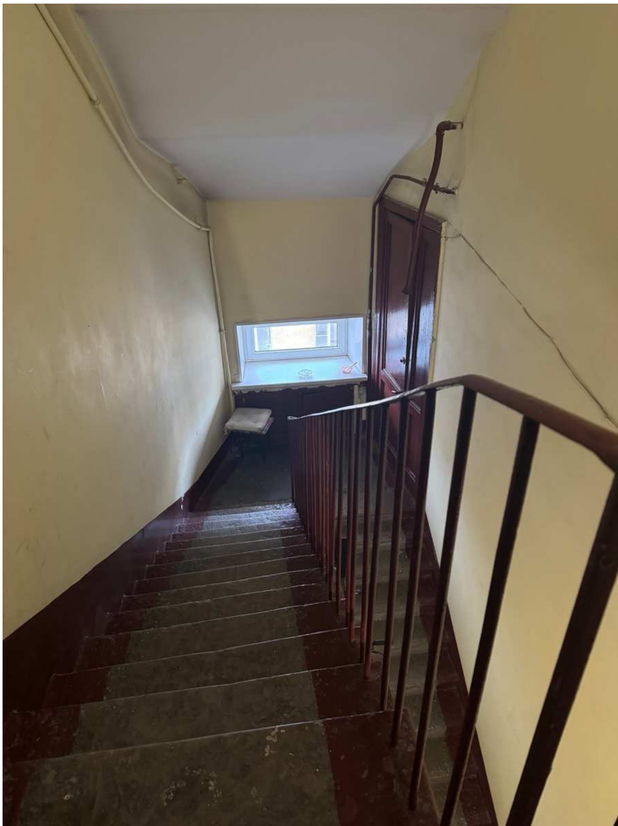
117. Общий вид лестницы 4ЛК объекта культурного наследия.
