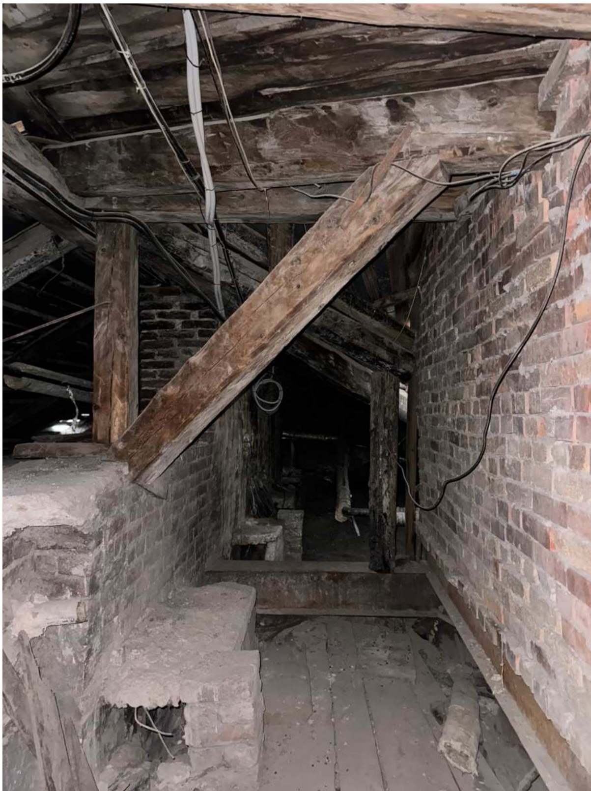
127. Общий вид чердачного помещения в части лестницы 4ЛК объекта культурного наследия.
