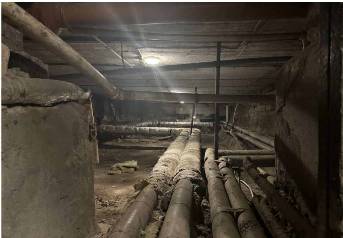
75. Интерьер подвальных помещений в части лестницы ЗЛК объекта культурного наследия.
