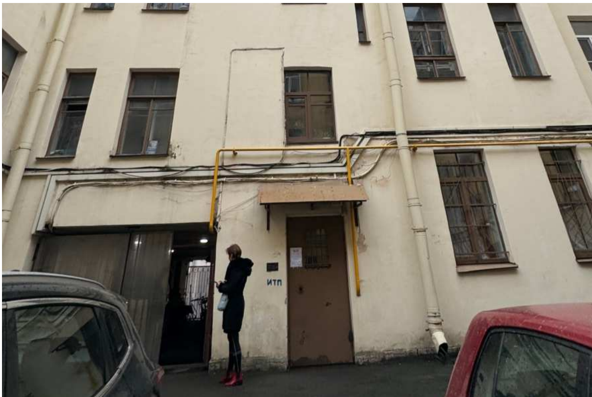
94. Вход в парадную лестницы 4ЛК объекта культурного наследия с восточного двора.
