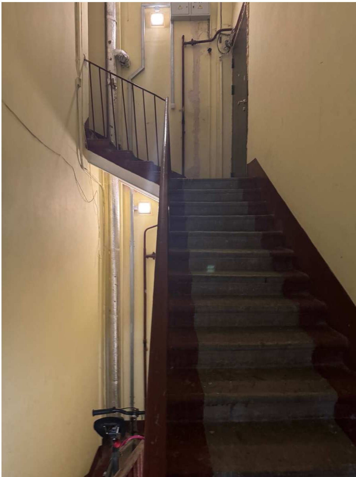
114. Общий вид лестницы 4ЛК объекта культурного наследия.
