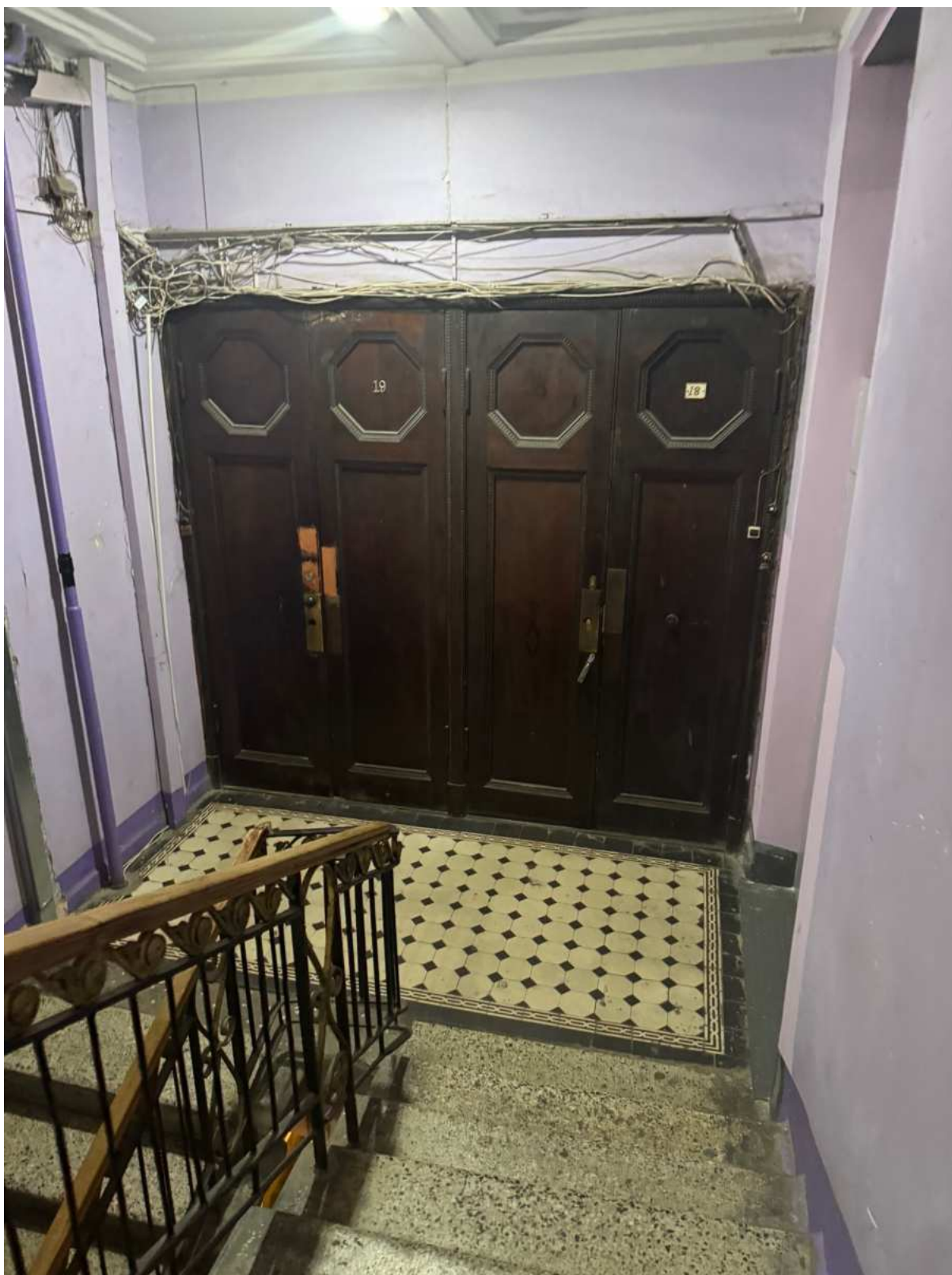
55. Общий вид лестницы 2ЛК объекта культурного наследия.
