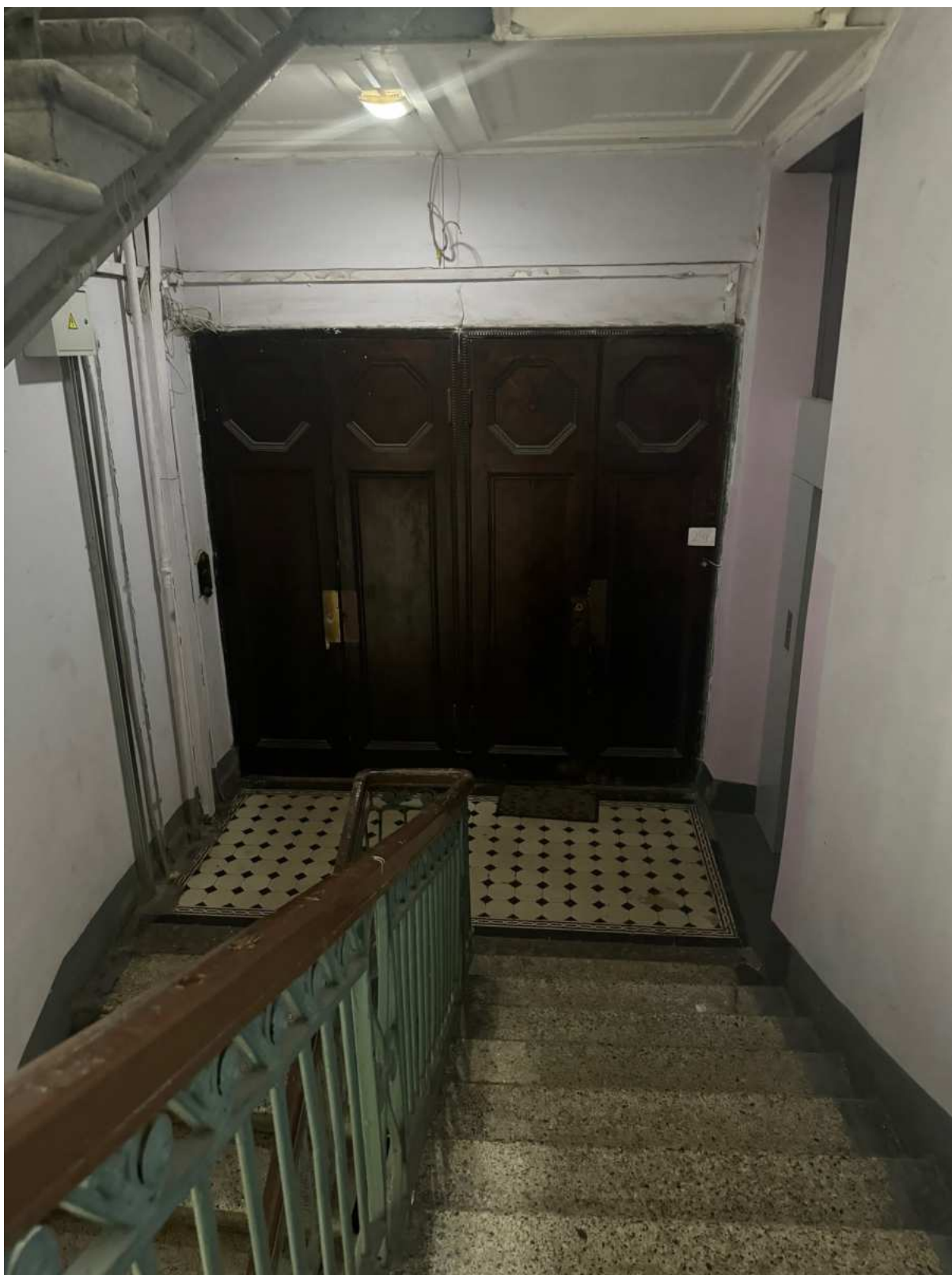
61. Общий вид лестницы 2ЛК объекта культурного наследия.
