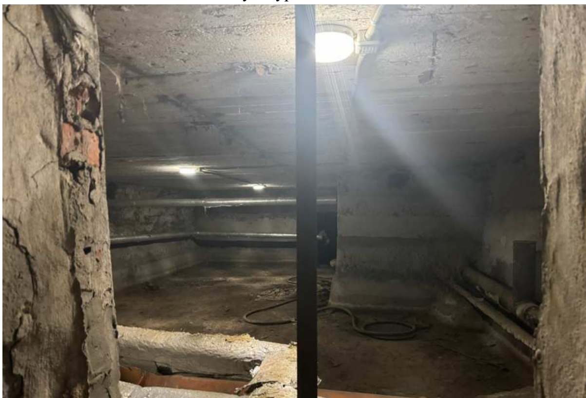
78. Интерьер подвальных помещений в части лестницы ЗЛК объекта культурного наследия.
