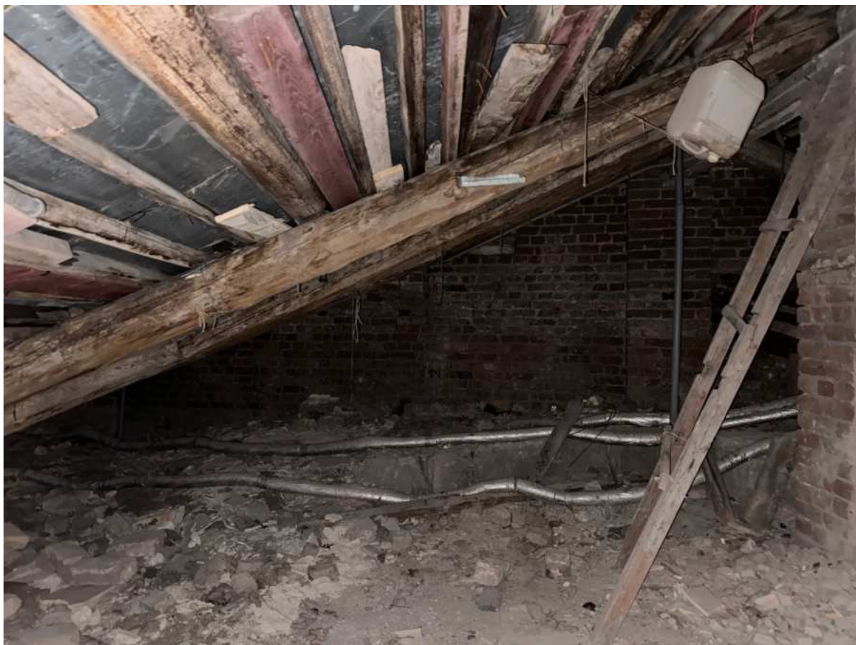
119. Общий вид чердачного помещения в части лестницы 4ЛК объекта культурного наследия.
