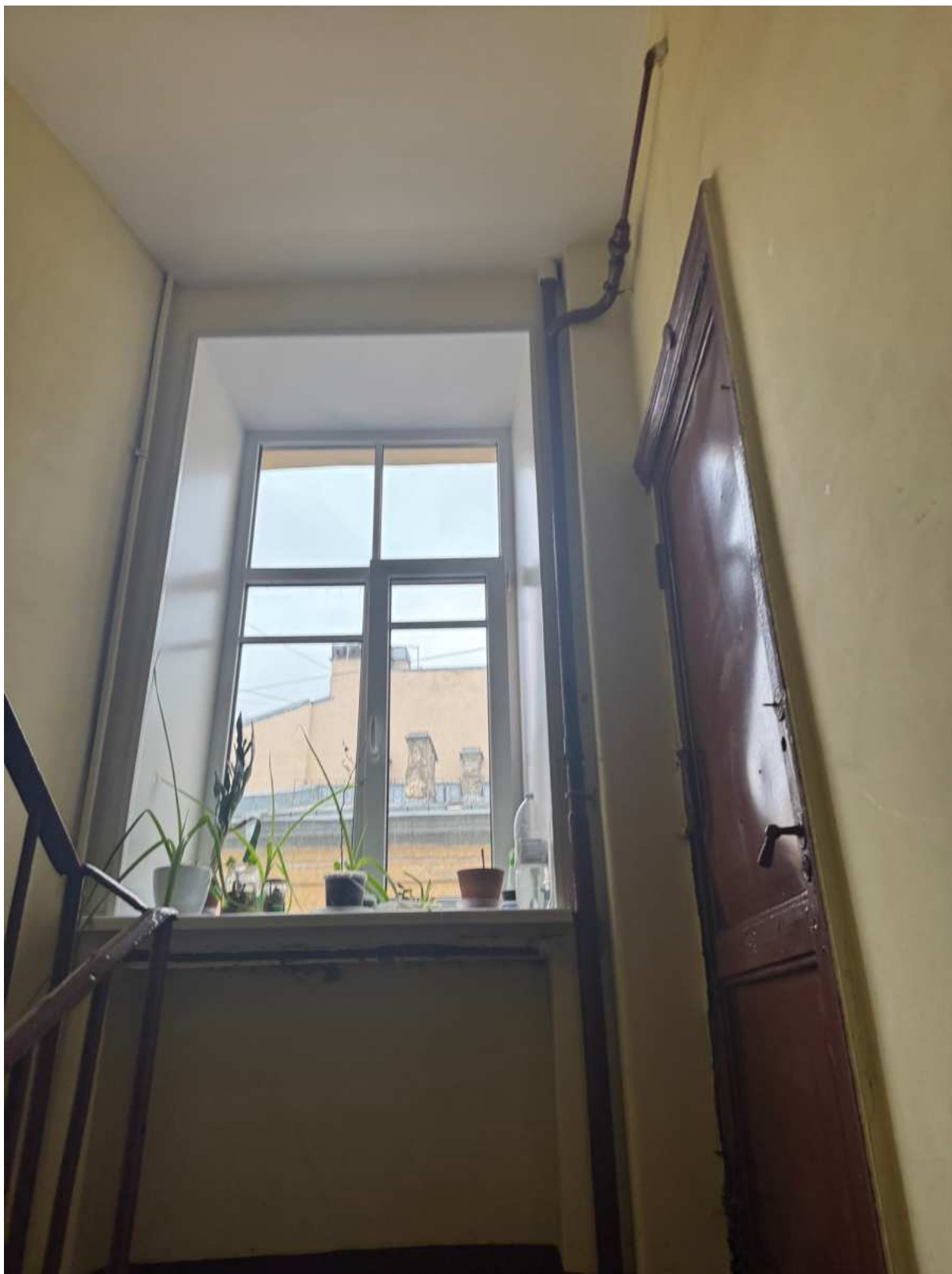
106. Оконное заполнение лестницы 4ЛК объекта культурного наследия.
