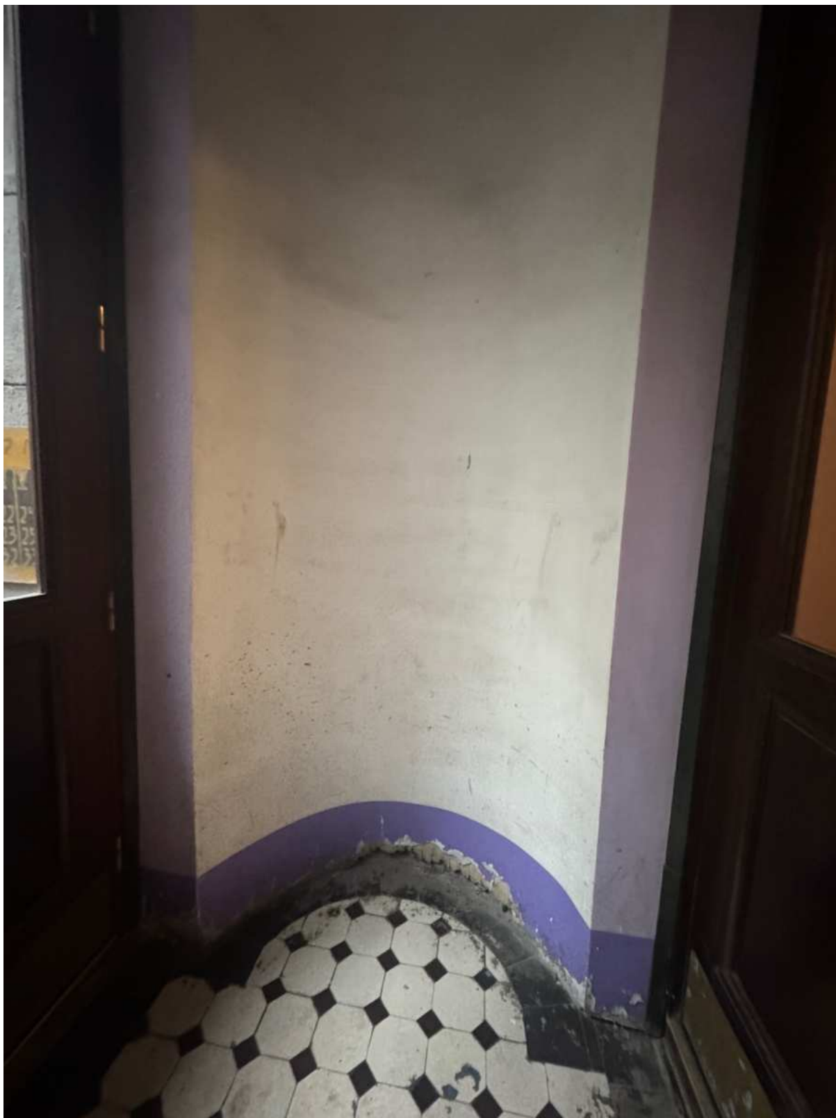
47. Тамбур, ведущий к лестнице 2ЛК, объекта культурного наследия.
