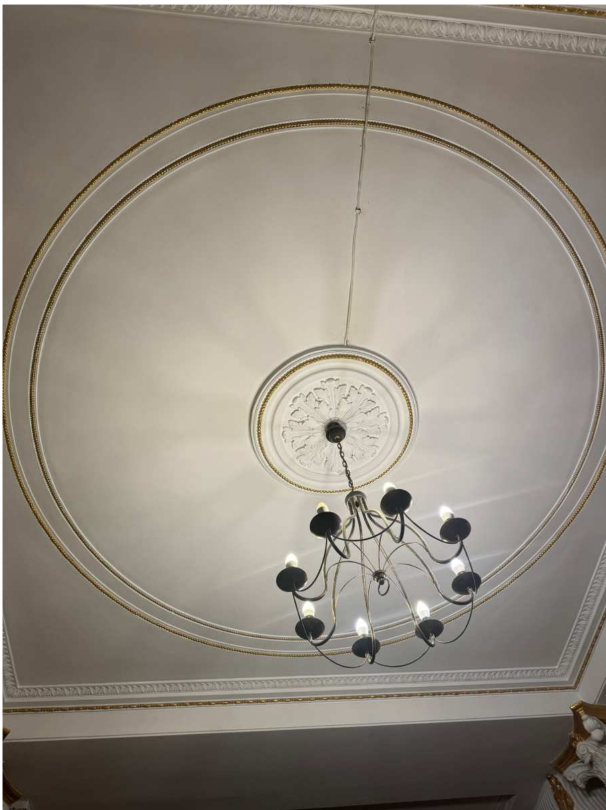
22. Потолок вестибюля лестницы 1ЛК объекта культурного наследия.
