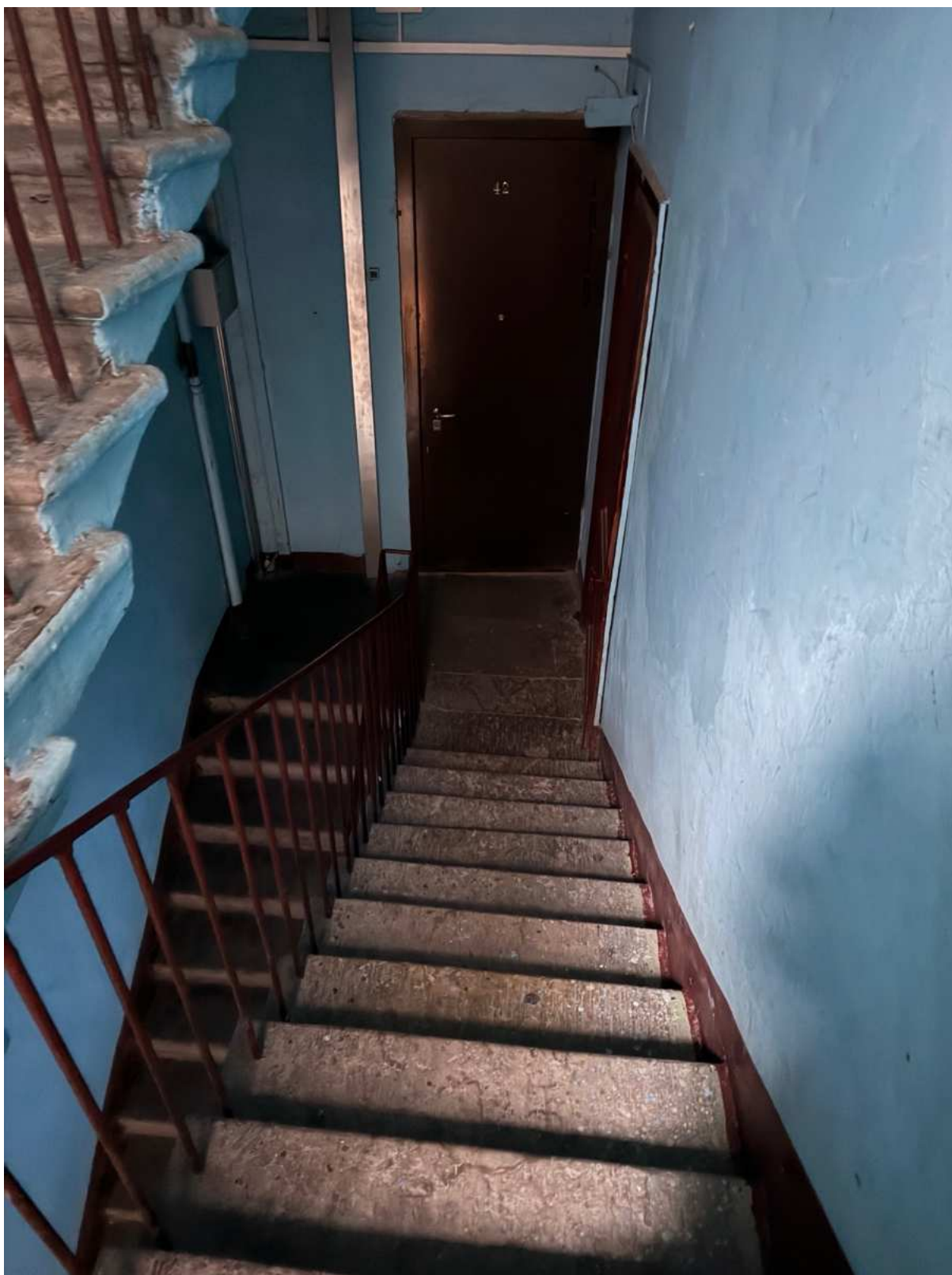
145. Общий вид лестницы 5ЛК объекта культурного наследия.
