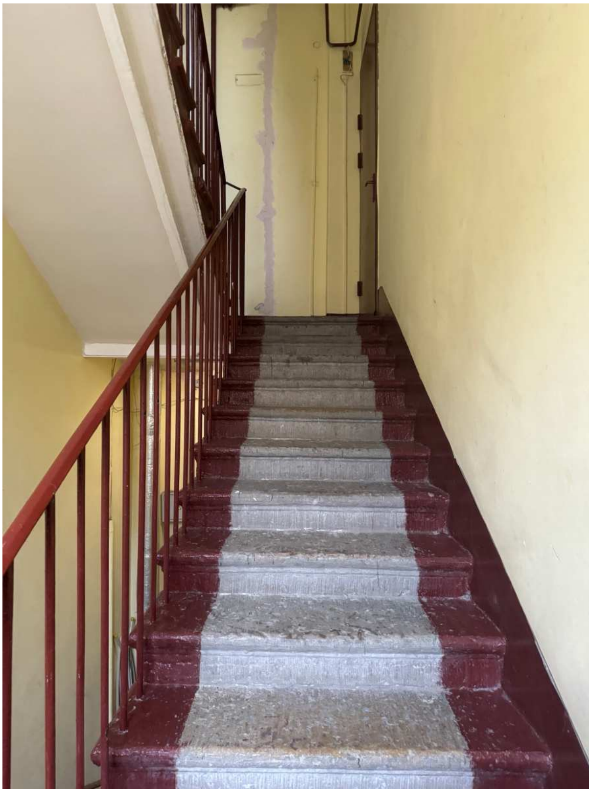
107. Общий вид лестницы 4ЛК объекта культурного наследия.
