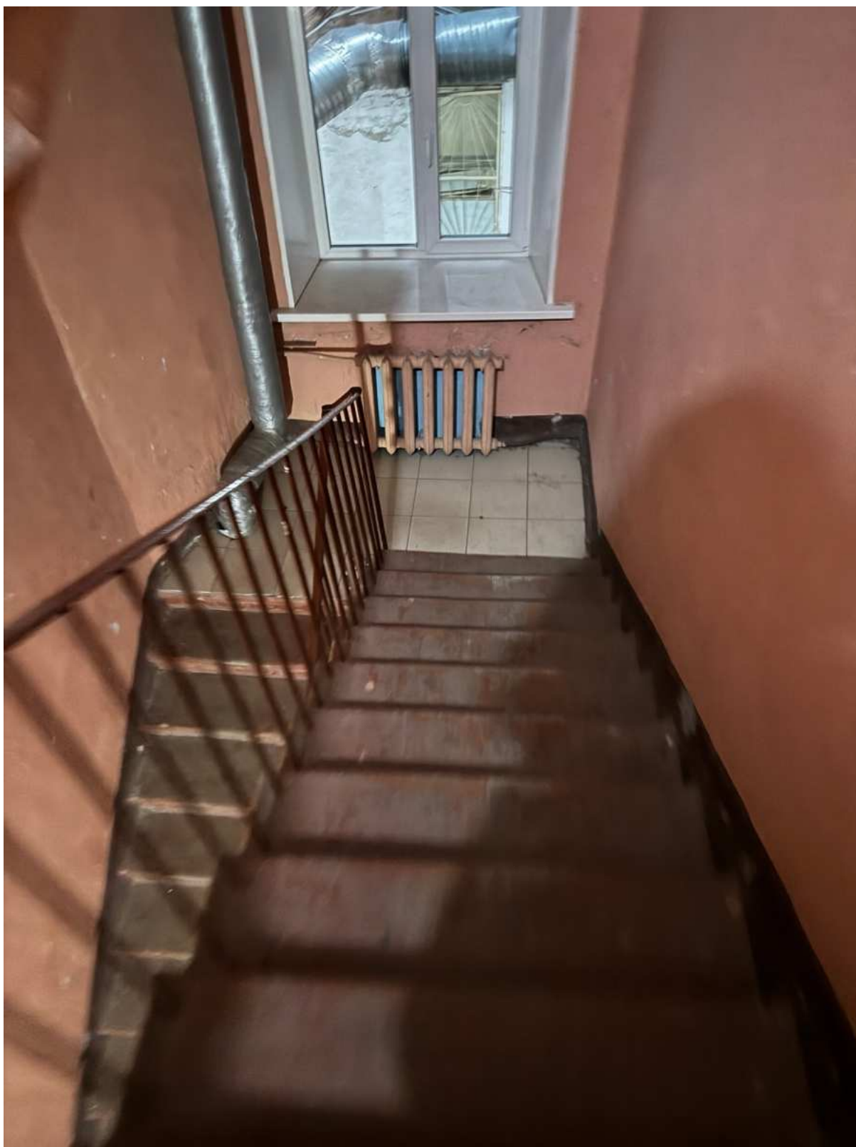
136. Общий вид лестницы 5ЛК объекта культурного наследия.
