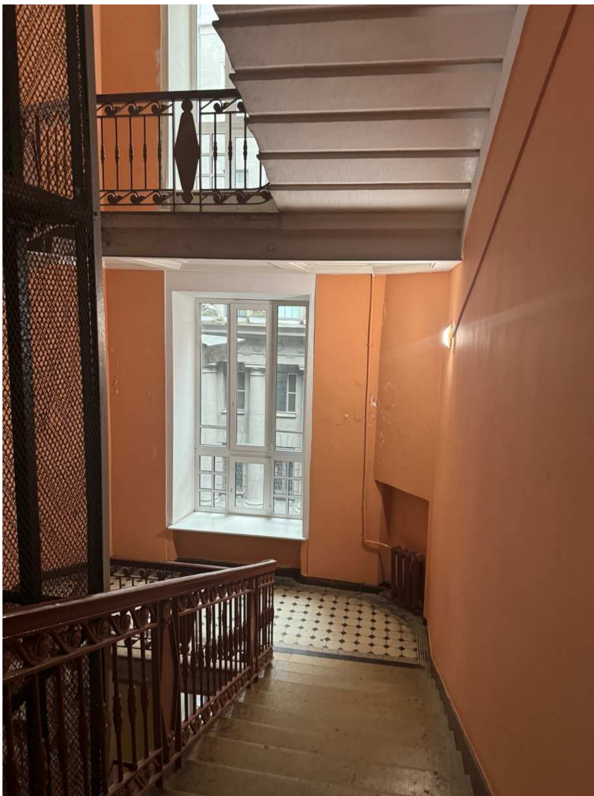
33.Общий вид лестницы 1ЛК объекта культурного наследия.
