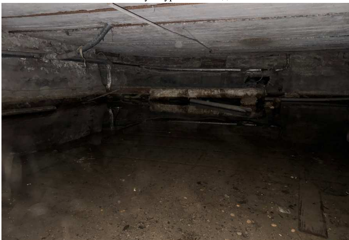
80. Интерьер подвальных помещений в части лестницы ЗЛК объекта культурного наследия.
