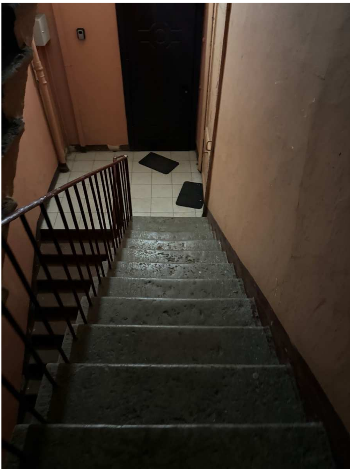
137. Общий вид лестницы 5ЛК объекта культурного наследия.
