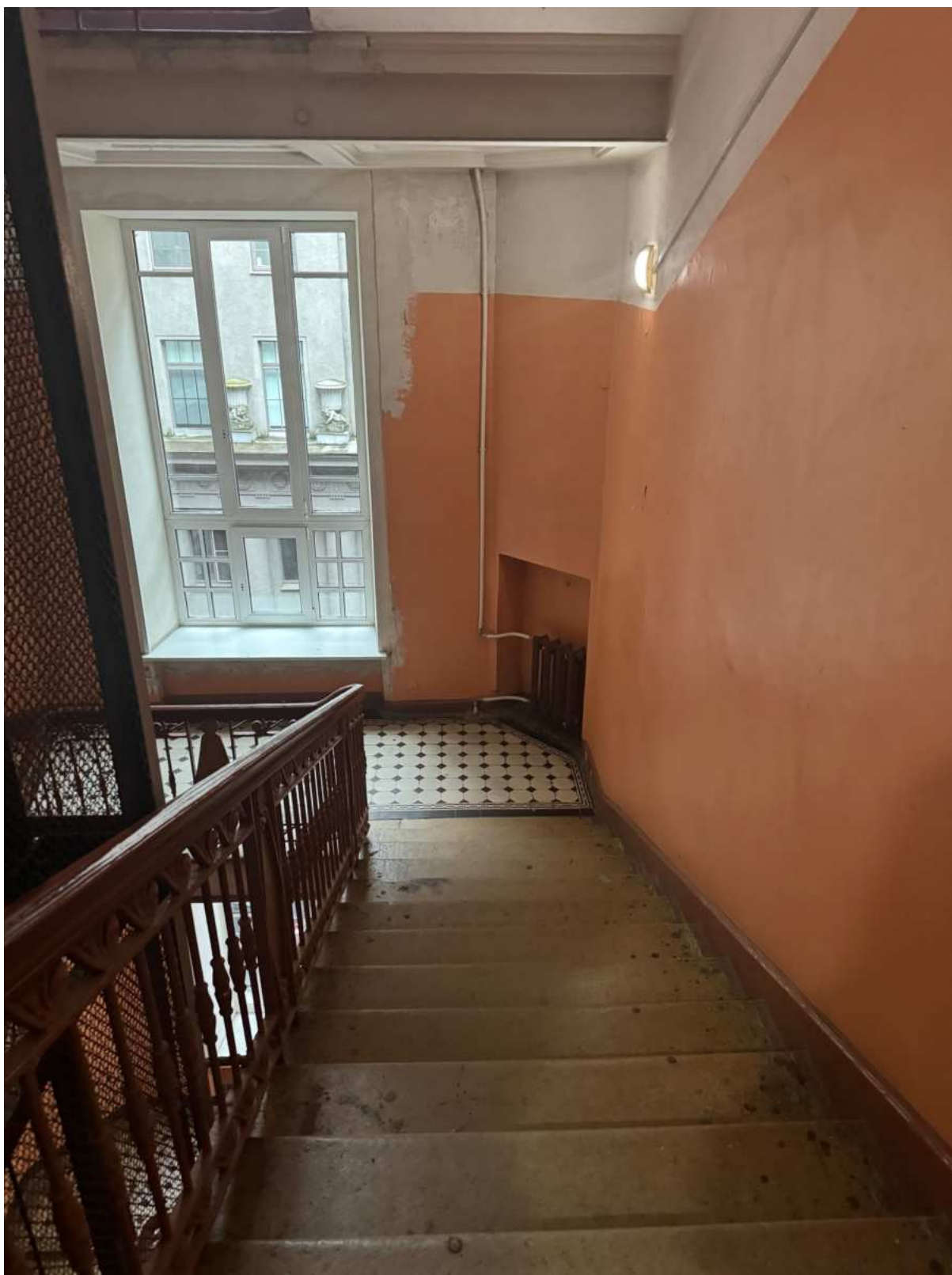
36. Общий вид лестницы 1ЛК объекта культурного наследия.
