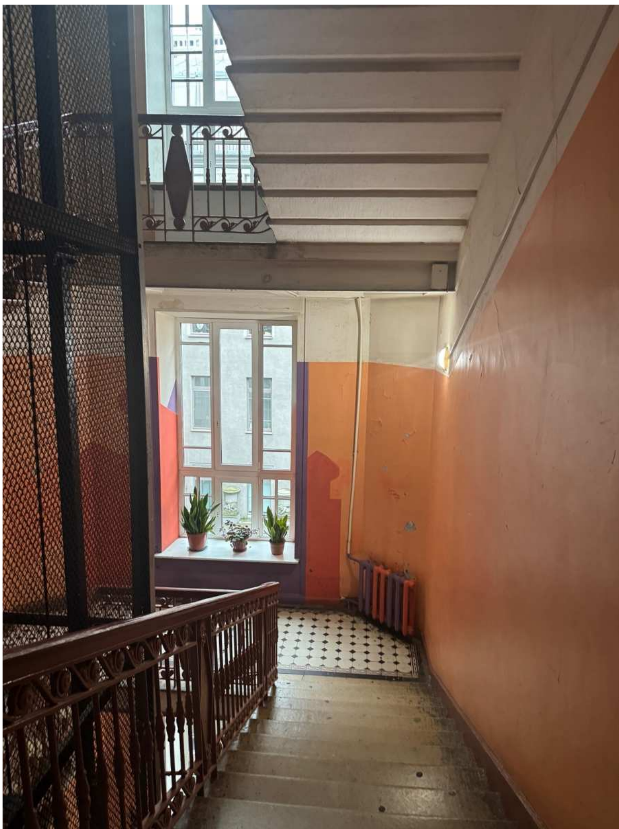
39. Общий вид лестницы 1ЛК объекта культурного наследия.
