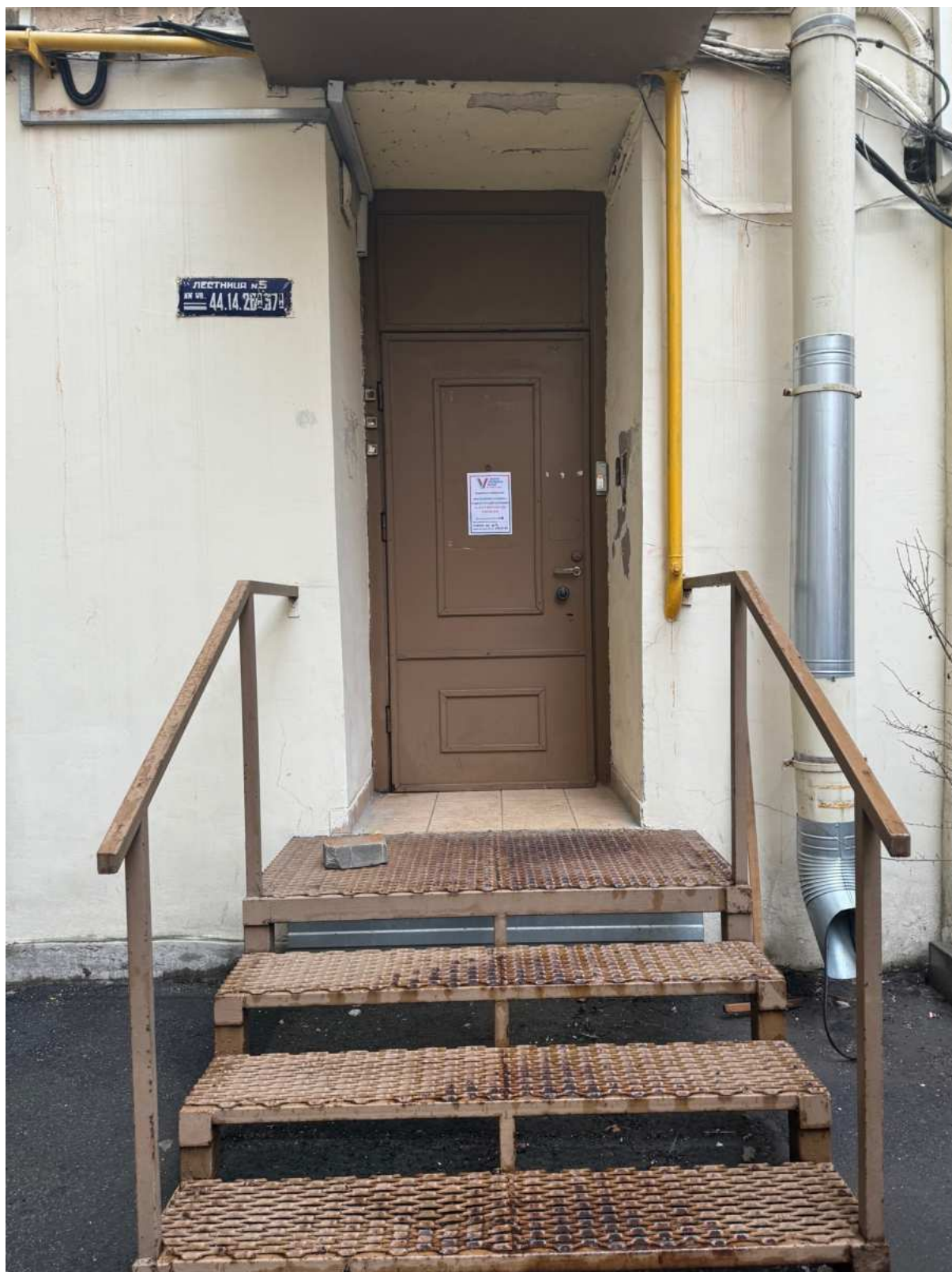
68. Вход на лестницу ЗЛК объекта культурного наследия с восточного двора.
