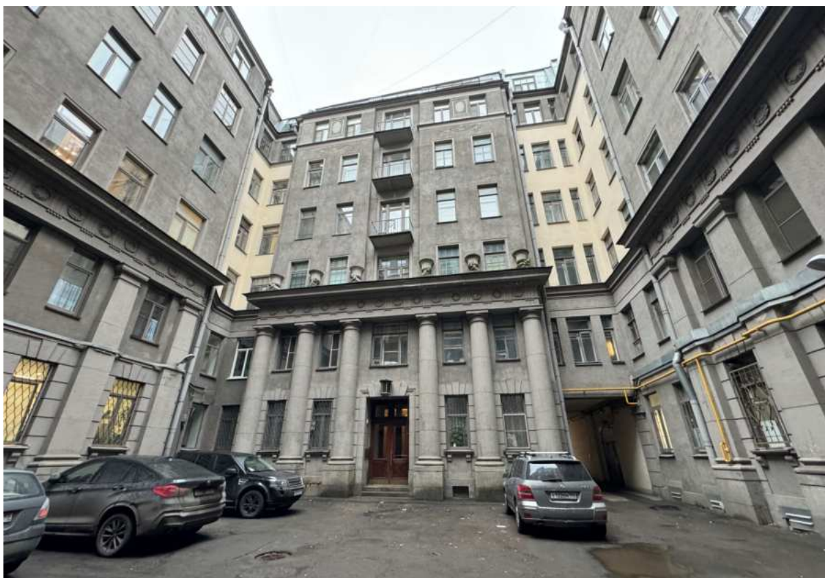
7. Общий вид дворовых фасадов объекта культурного наследия.
