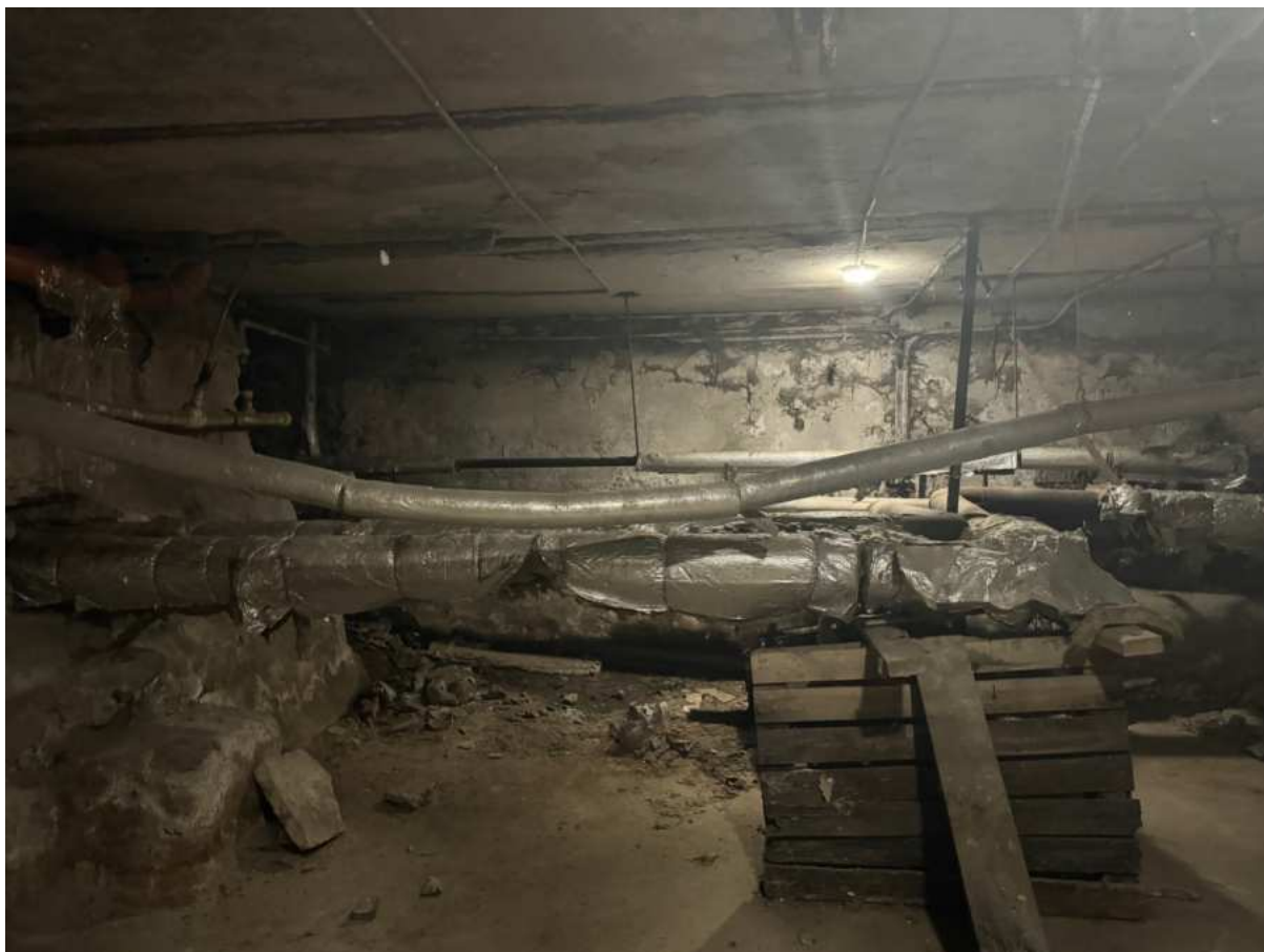
98. Общий вид подвального помещения в части лестницы 4ЛК объекта культурного наследия.
