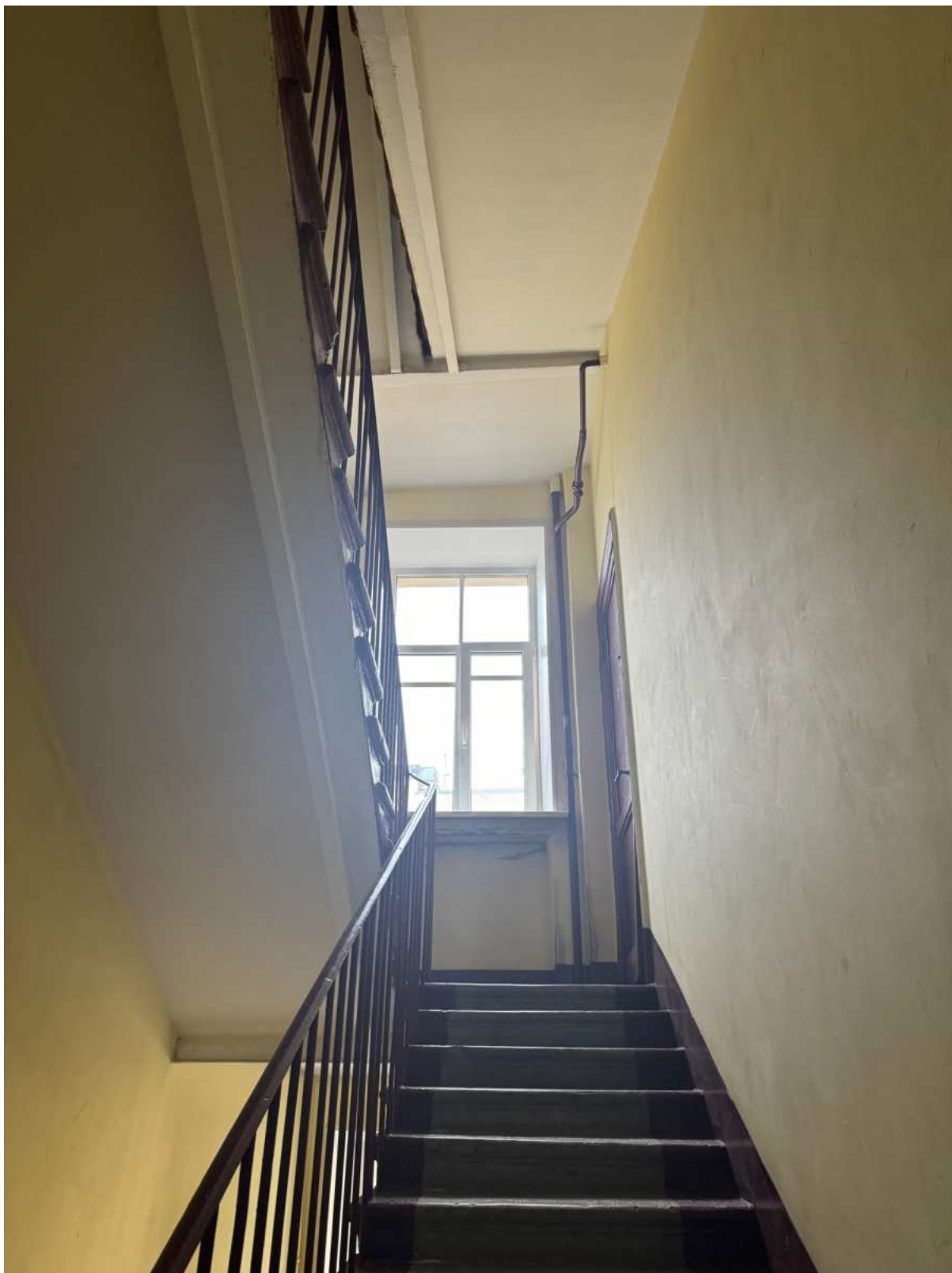
109. Общий вид лестницы 4ЛК объекта культурного наследия.
