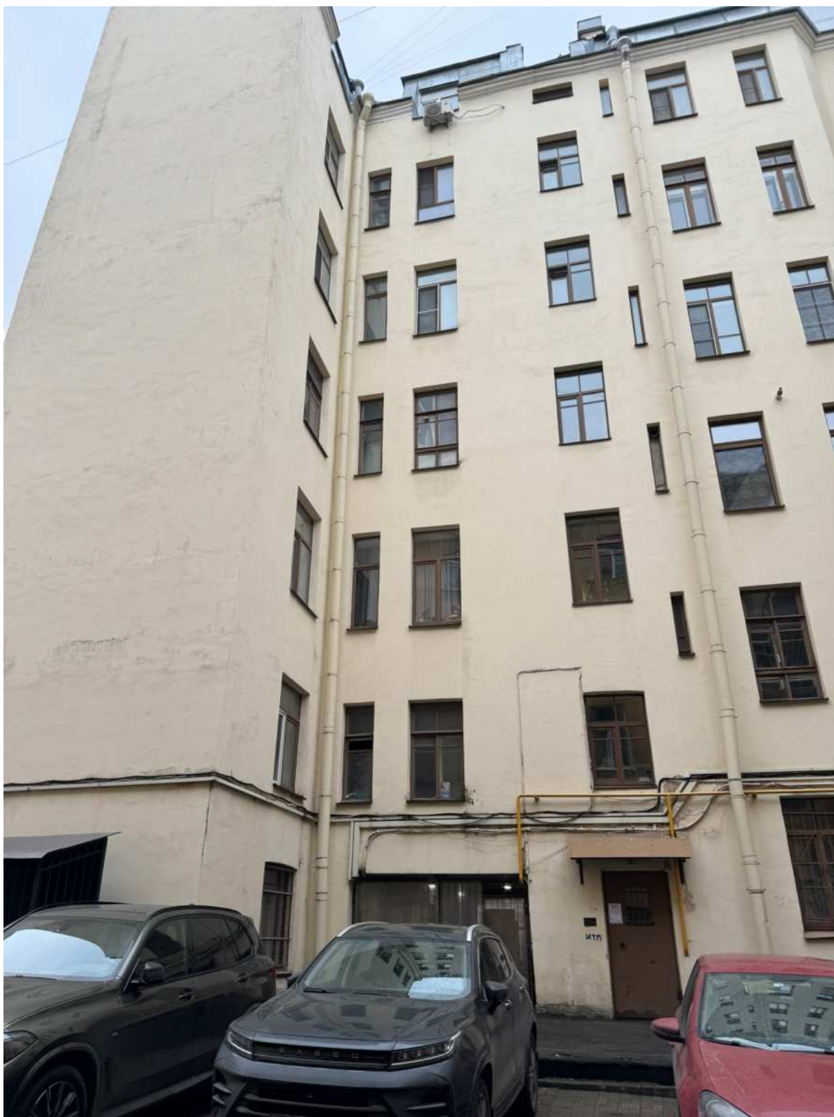
16. Дворовые фасады южного корпуса объекта культурного наследия.
