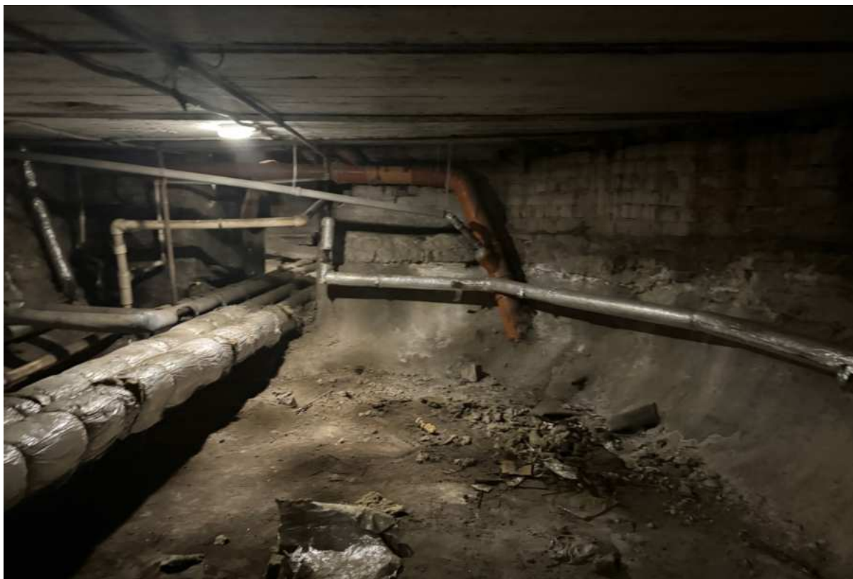
77. Интерьер подвальных помещений в части лестницы ЗЛК объекта культурного наследия.
