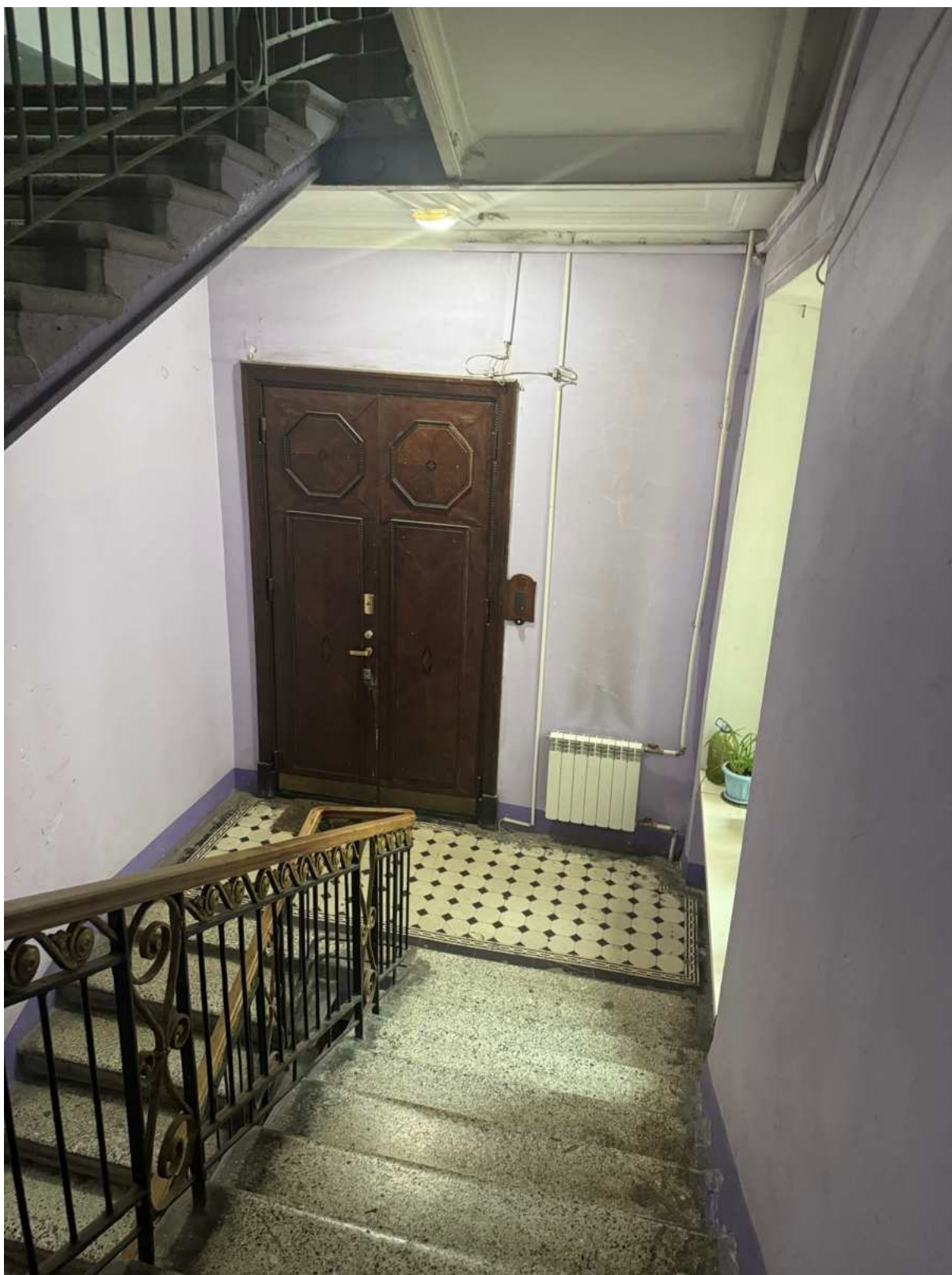
56. Общий вид лестницы 2ЛК объекта культурного наследия.
