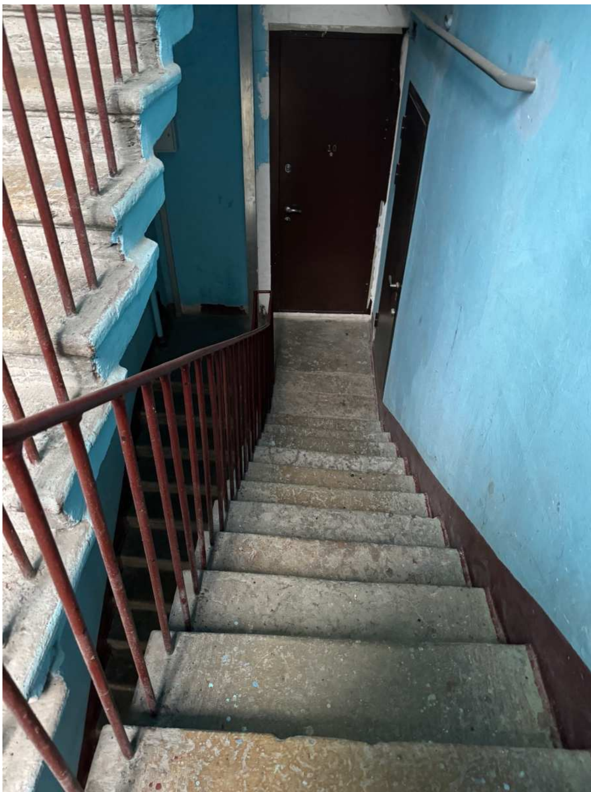
147. Общий вид лестницы 5ЛК объекта культурного наследия.
