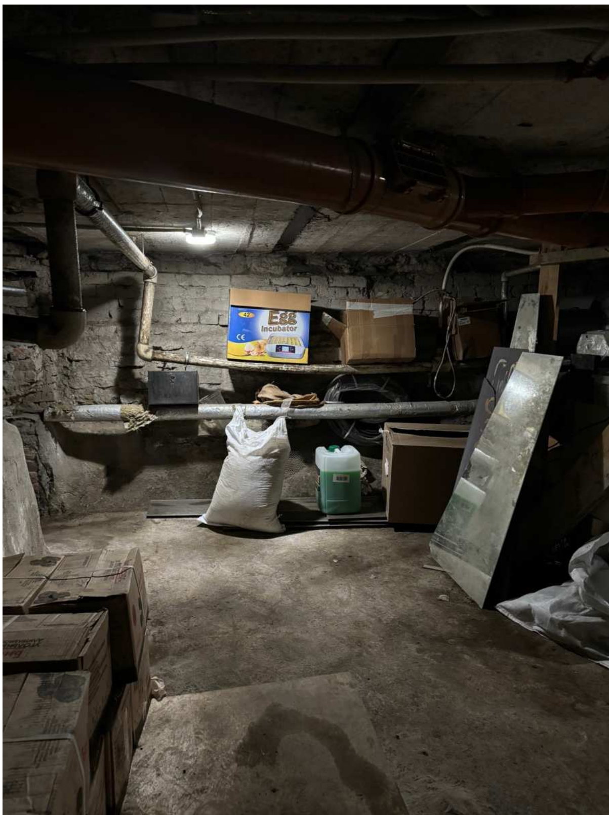
132. Общий вид подвального помещения в части лестницы 5ЛК объекта культурного наследия.
