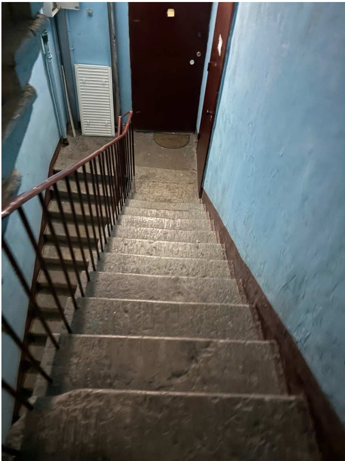
142. Общий вид лестницы 5ЛК объекта культурного наследия.
