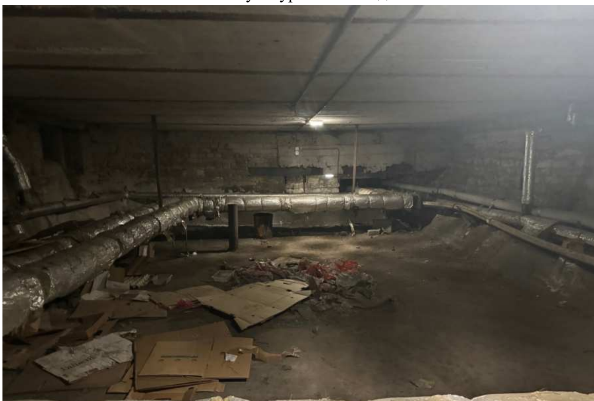
76. Интерьер подвальных помещений в части лестницы ЗЛК объекта культурного наследия.
