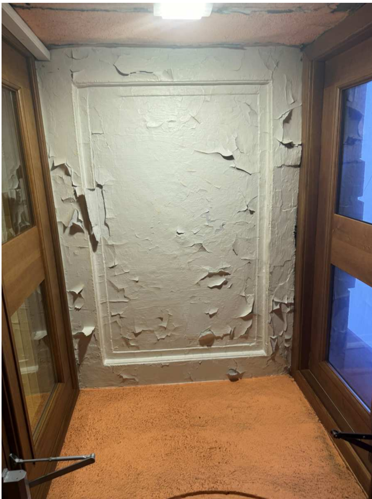
20. Тамбур лестницы 1ЛК объекта культурного наследия.
