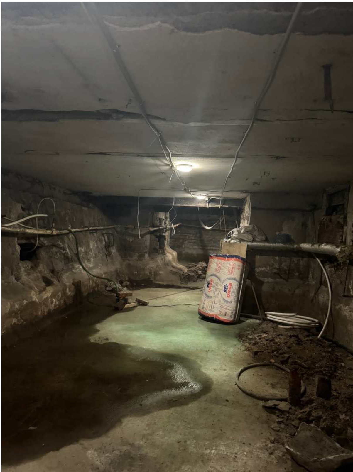
97. Общий вид подвального помещения в части лестницы 4ЛК объекта культурного наследия.
