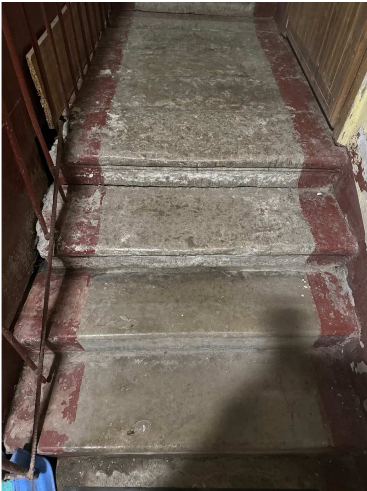
95. Ступени лестницы 4ЛК объекта культурного наследия.
