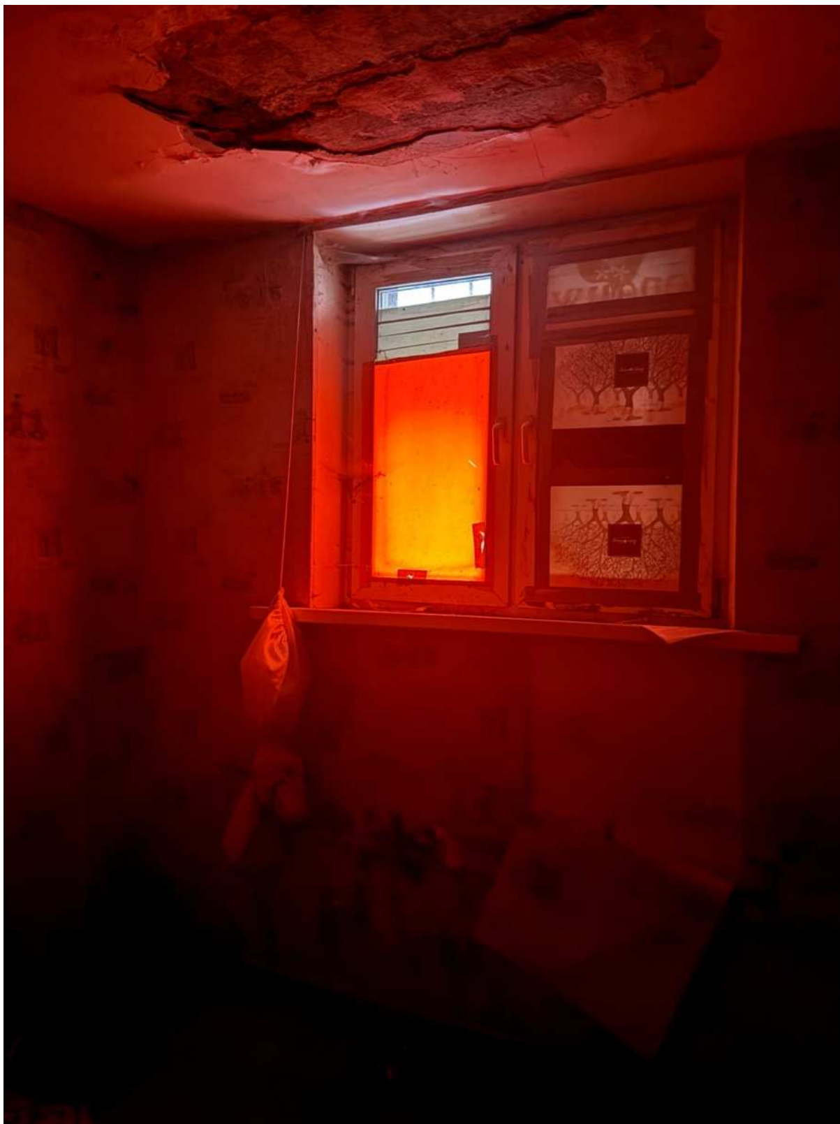
24. Интерьер подвального помещения в части лестницы 1ЛК объекта культурного наследия.
