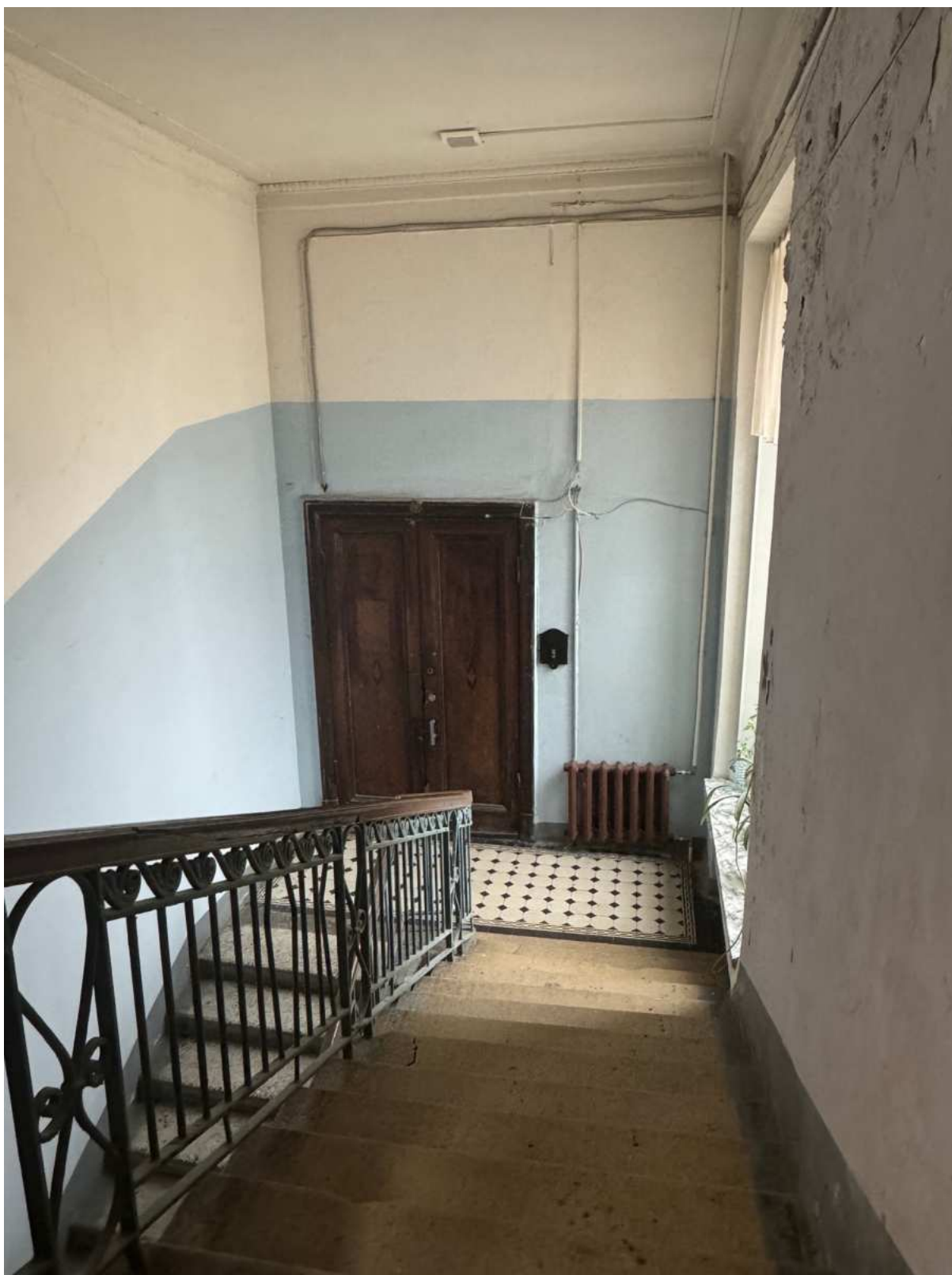
66. Общий вид лестницы 2ЛК объекта культурного наследия.
