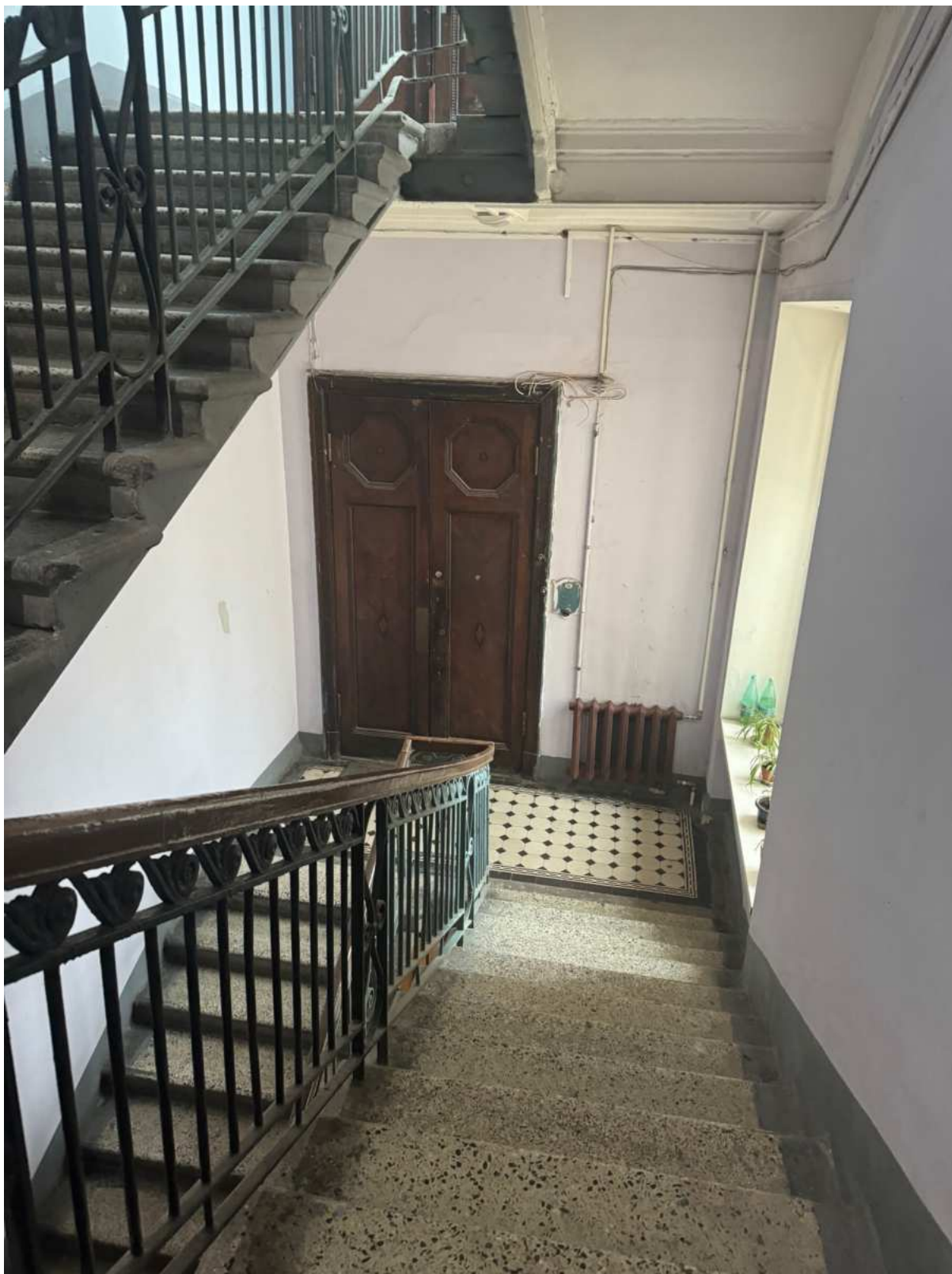
62. Общий вид лестницы 2ЛК объекта культурного наследия.
