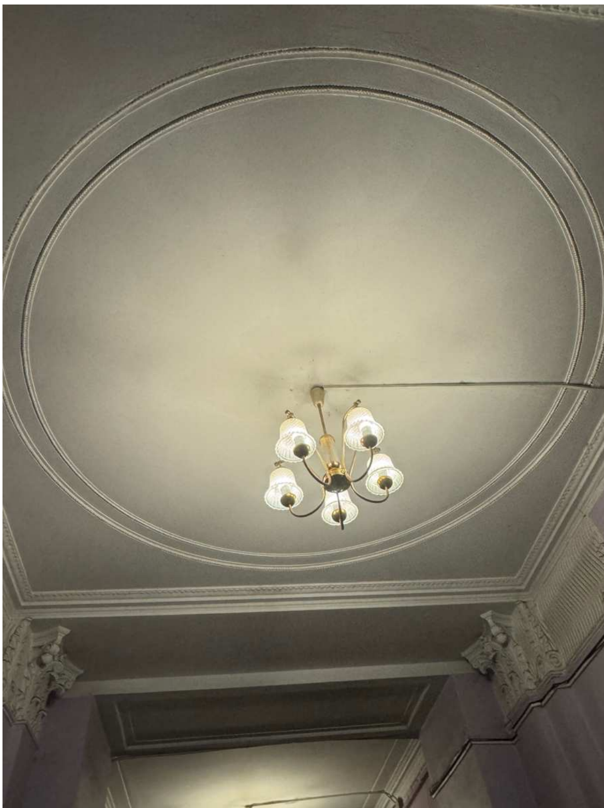
50. Потолок вестибюля объекта культурного наследия в части лестницы 2ЛК.
