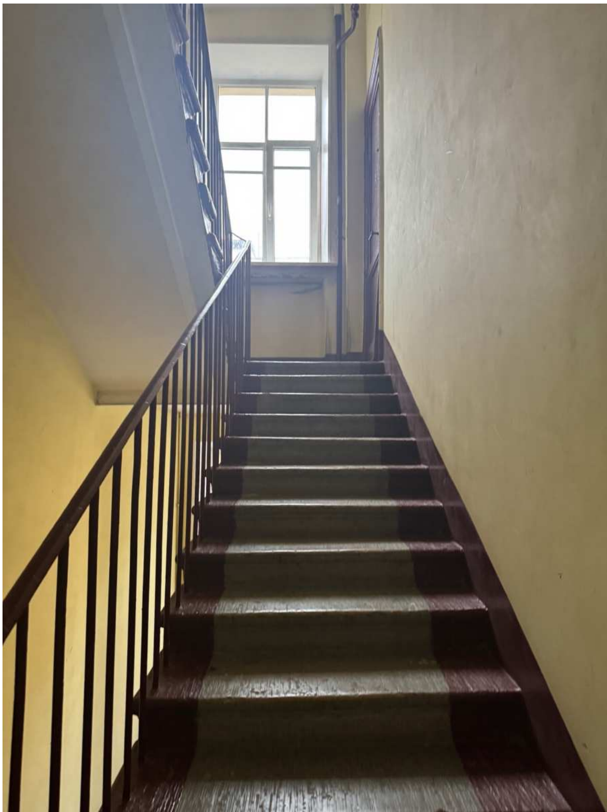
108. Общий вид лестницы 4ЛК объекта культурного наследия.
