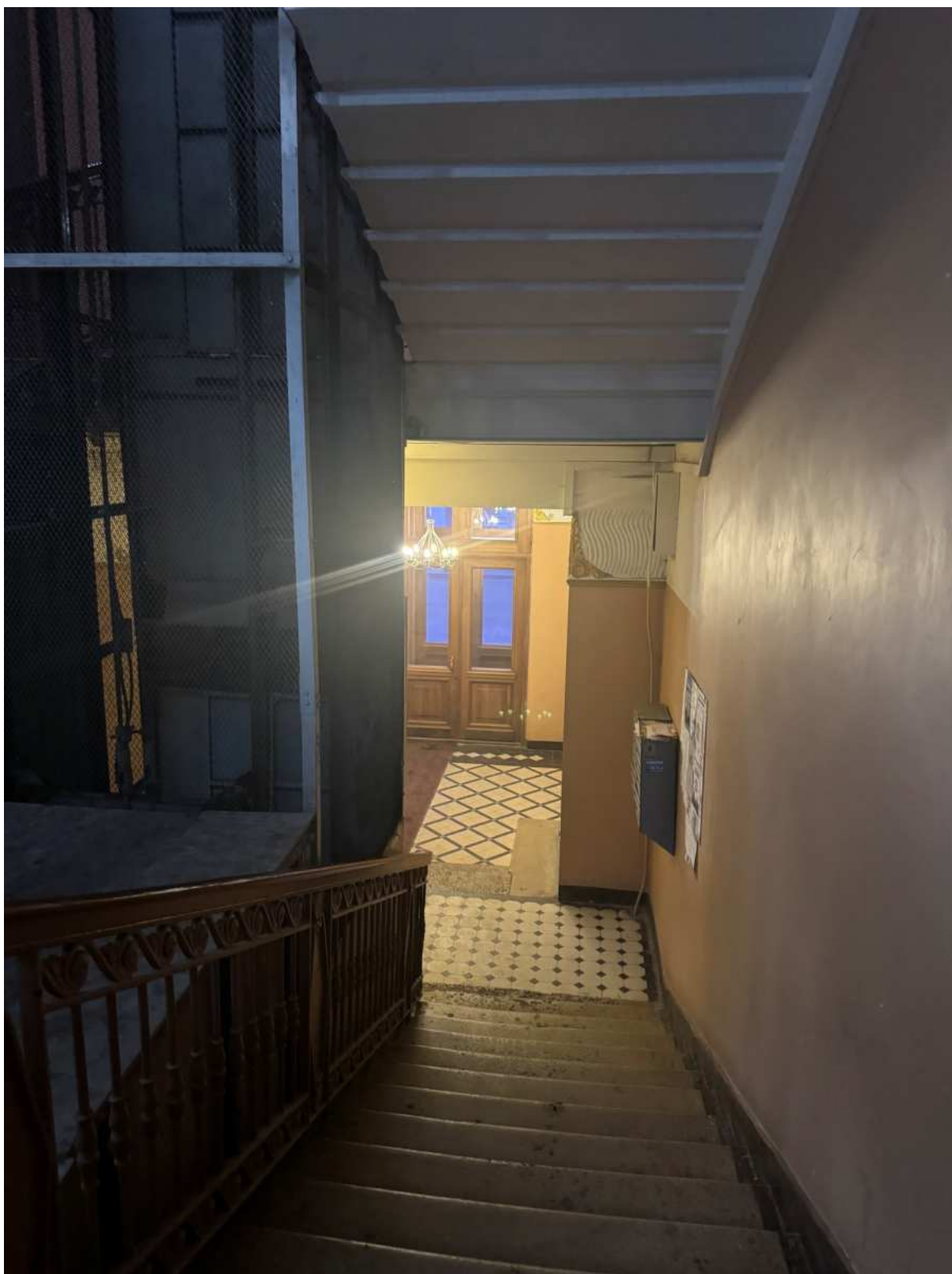
27. Общий вид вестибюля и лестницы 1ЛК объекта культурного наследия.
