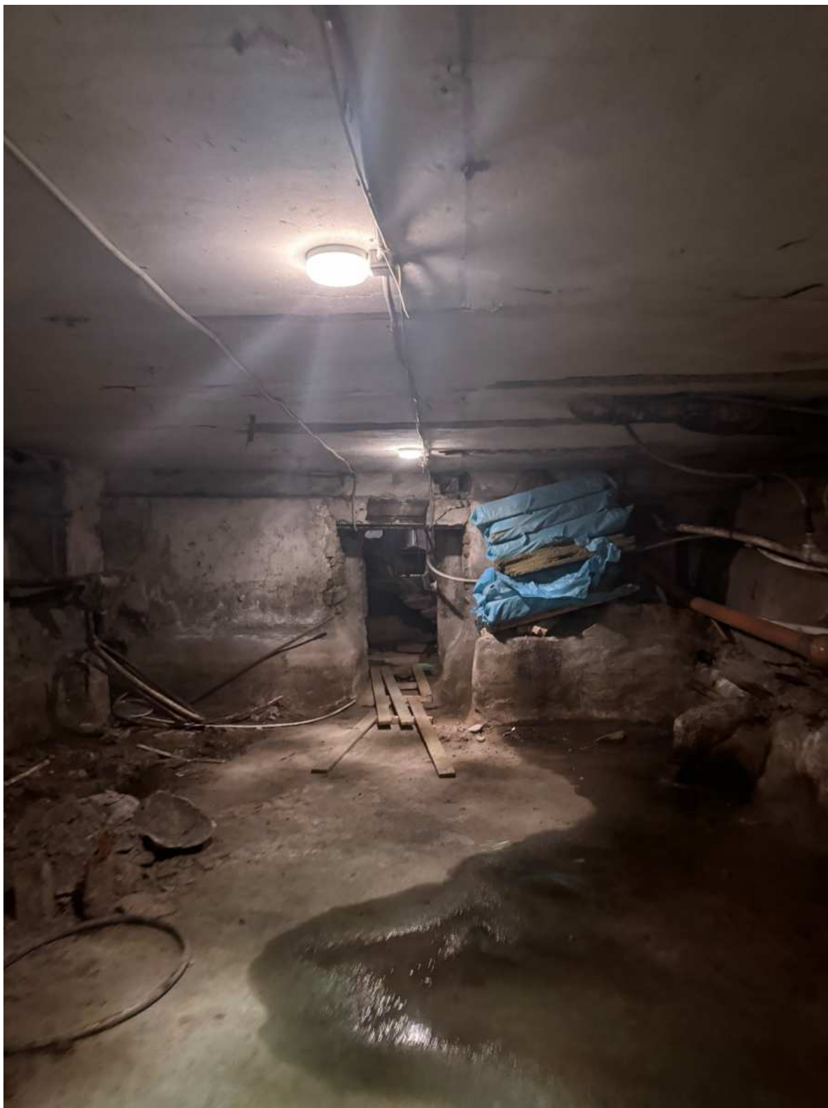
100. Общий вид подвального помещения в части лестницы 4ЛК объекта культурного наследия.
