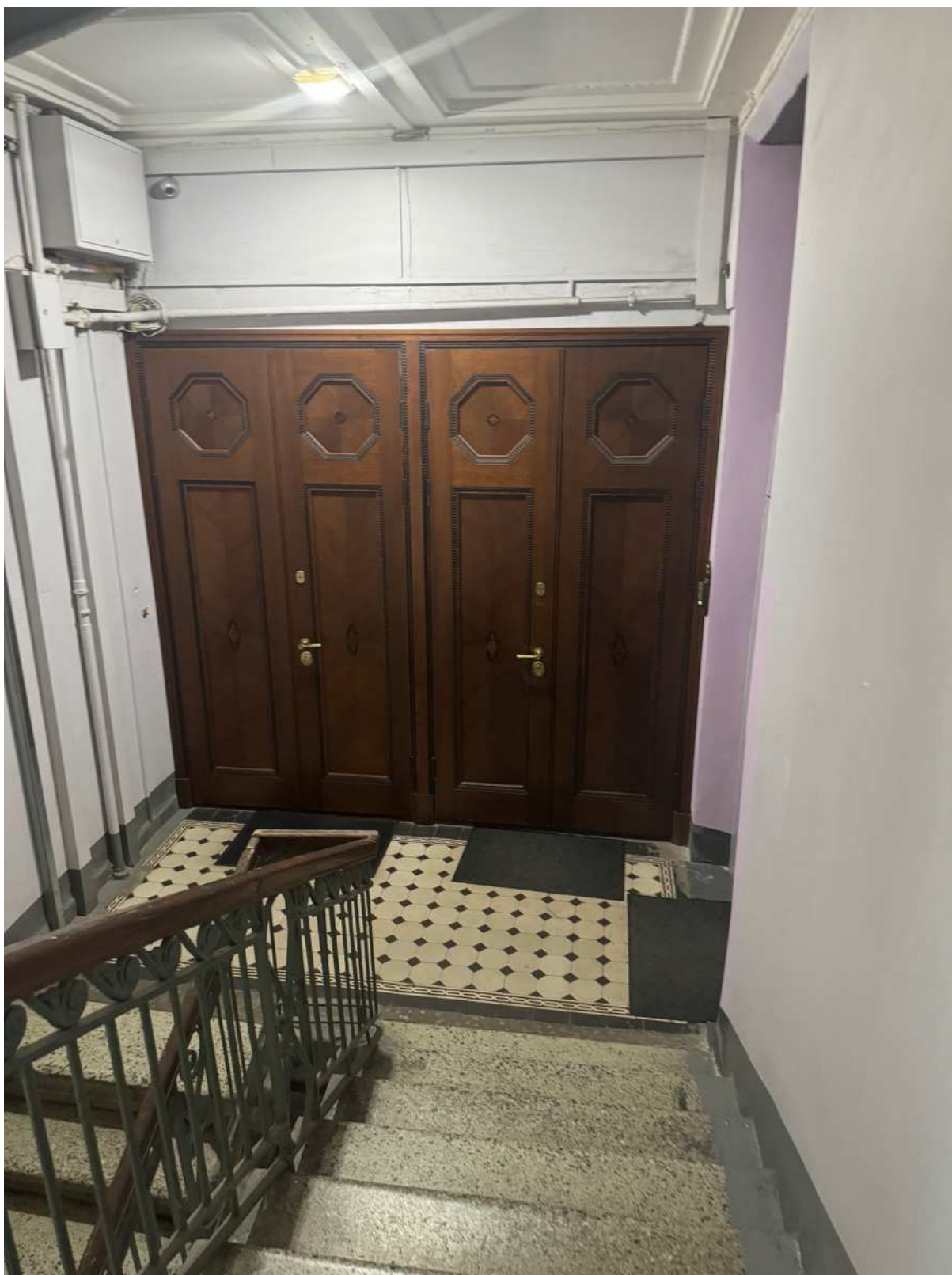
59. Общий вид лестницы 2ЛК объекта культурного наследия.
