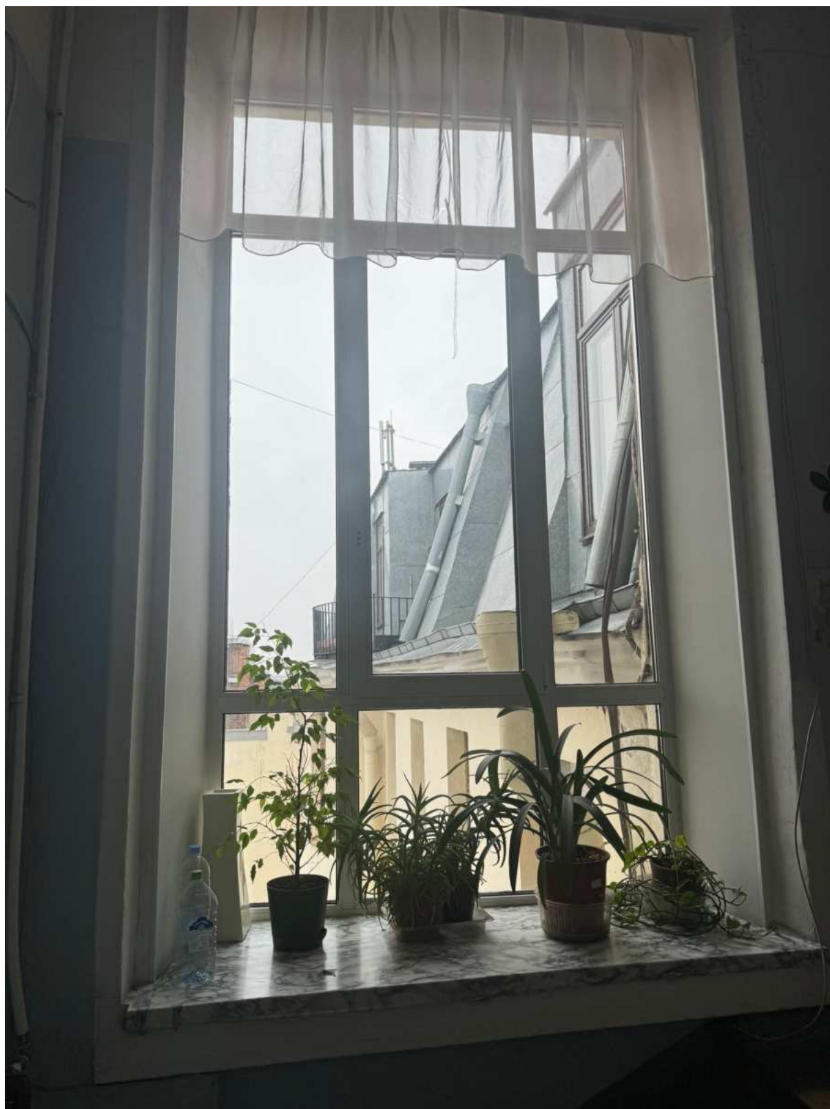
65. Оконное заполнение парадной лестницы 2ЛК объекта культурного наследия.
