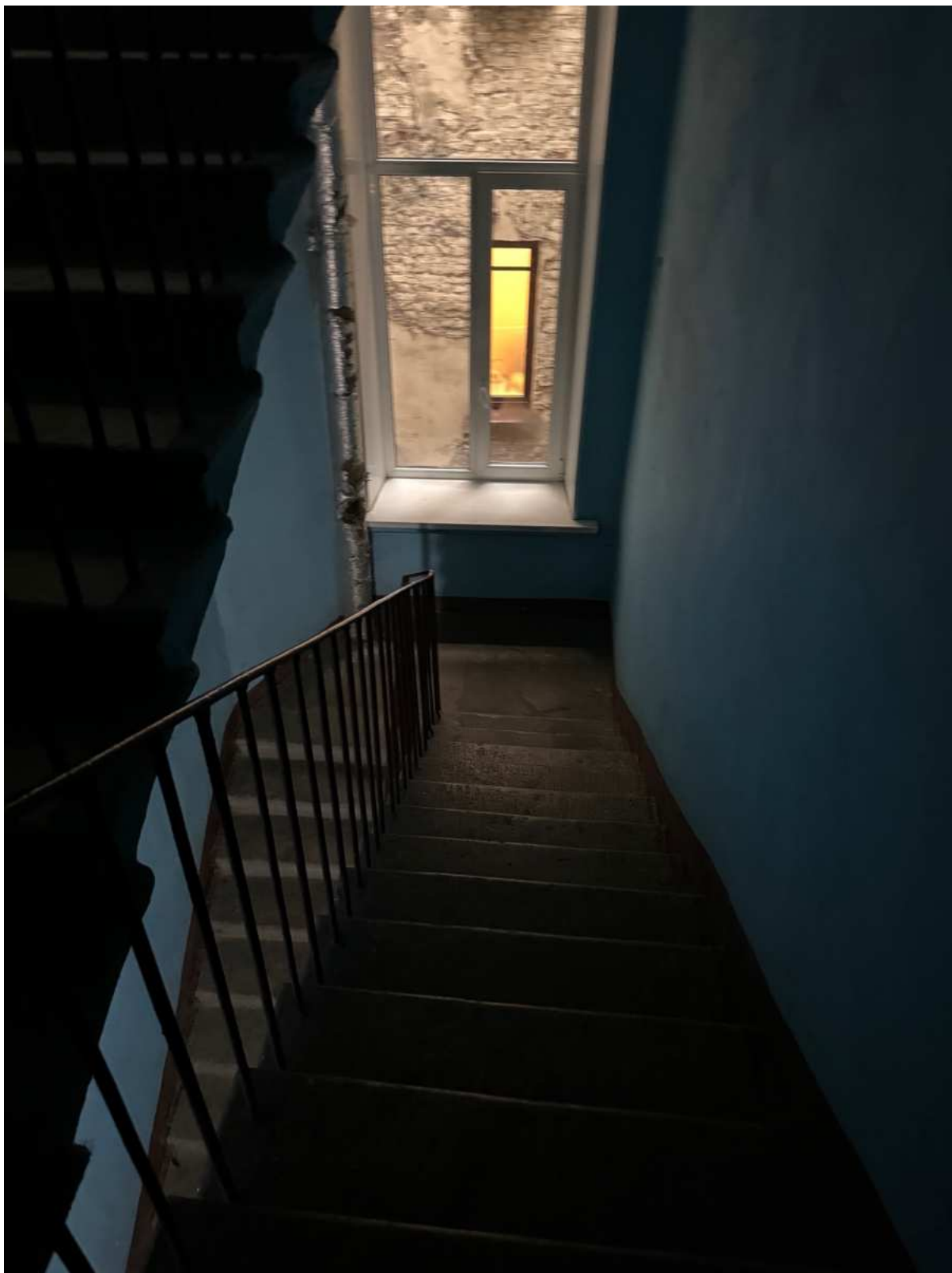
144. Общий вид лестницы 5ЛК объекта культурного наследия.
