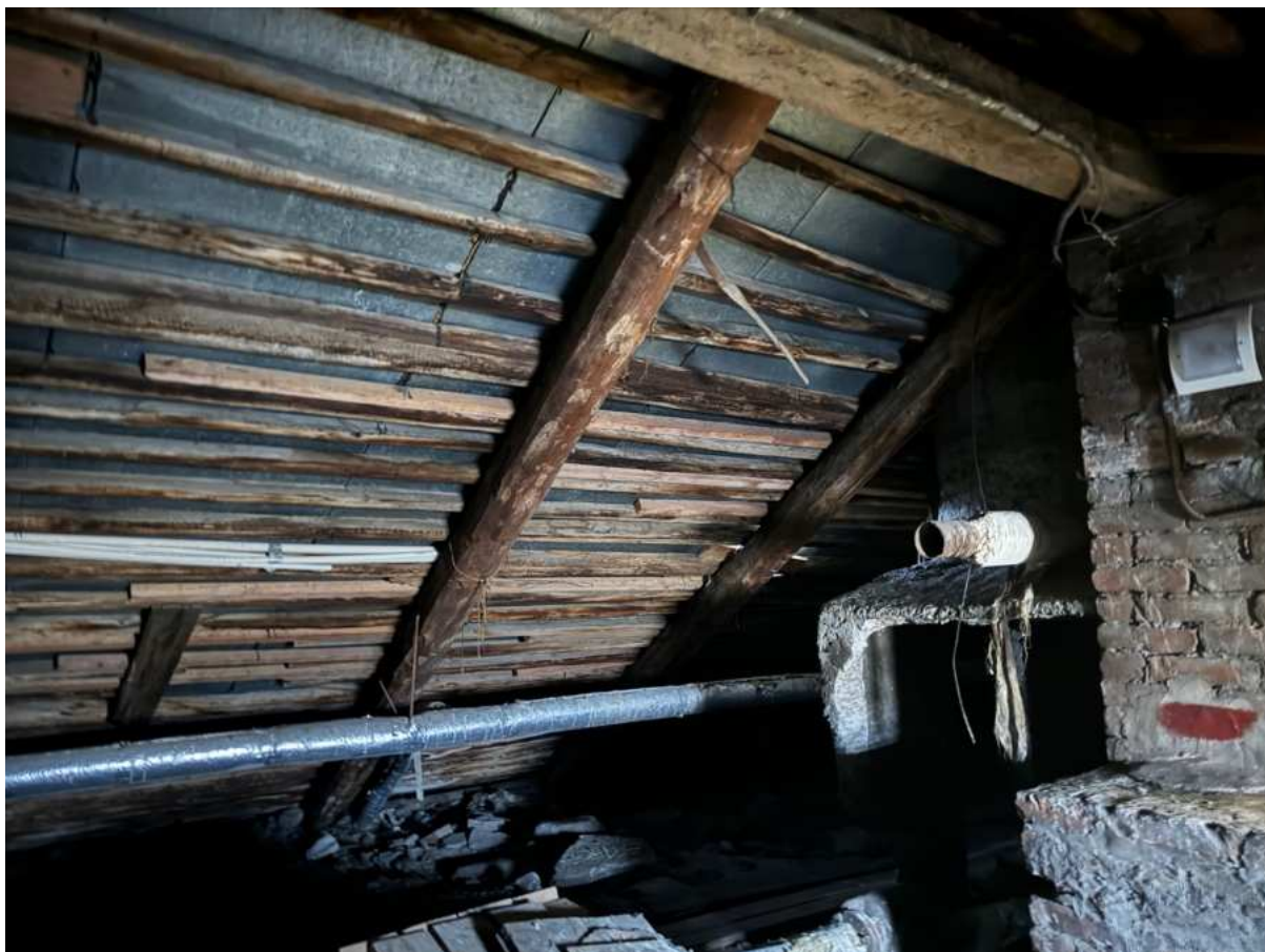
120. Общий вид чердачного помещения в части лестницы 4ЛК объекта культурного наследия.
