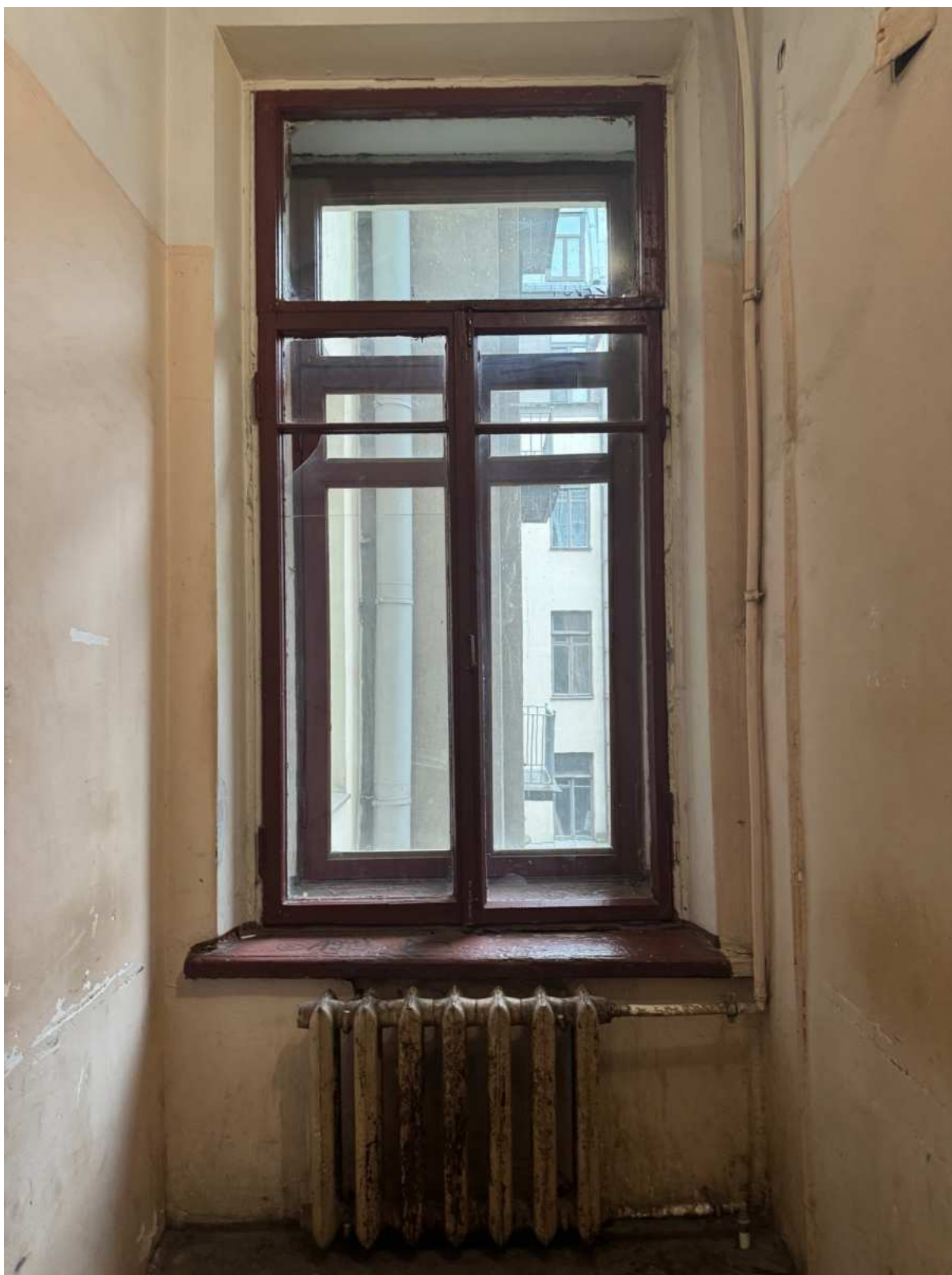
88. Оконное заполнение лестницы ЗЛК объекта культурного наследия.
