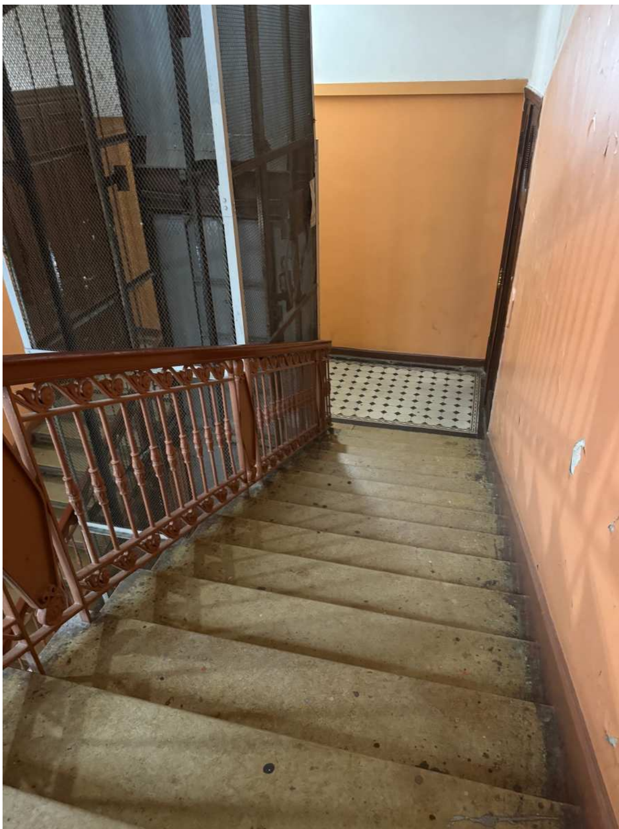
37.Общий вид лестницы 1ЛК объекта культурного наследия.
