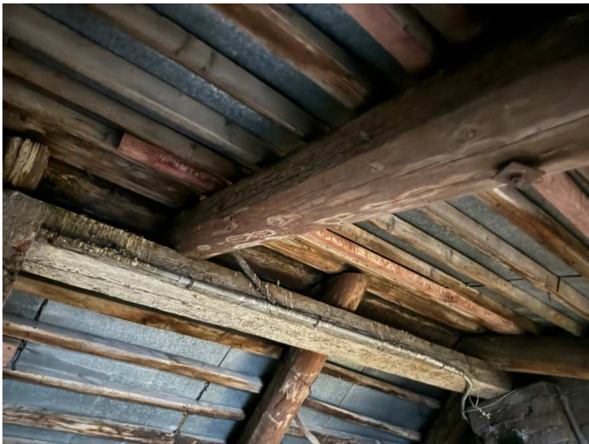
121. Общий вид чердачного помещения в части лестницы 4ЛК объекта культурного наследия.
