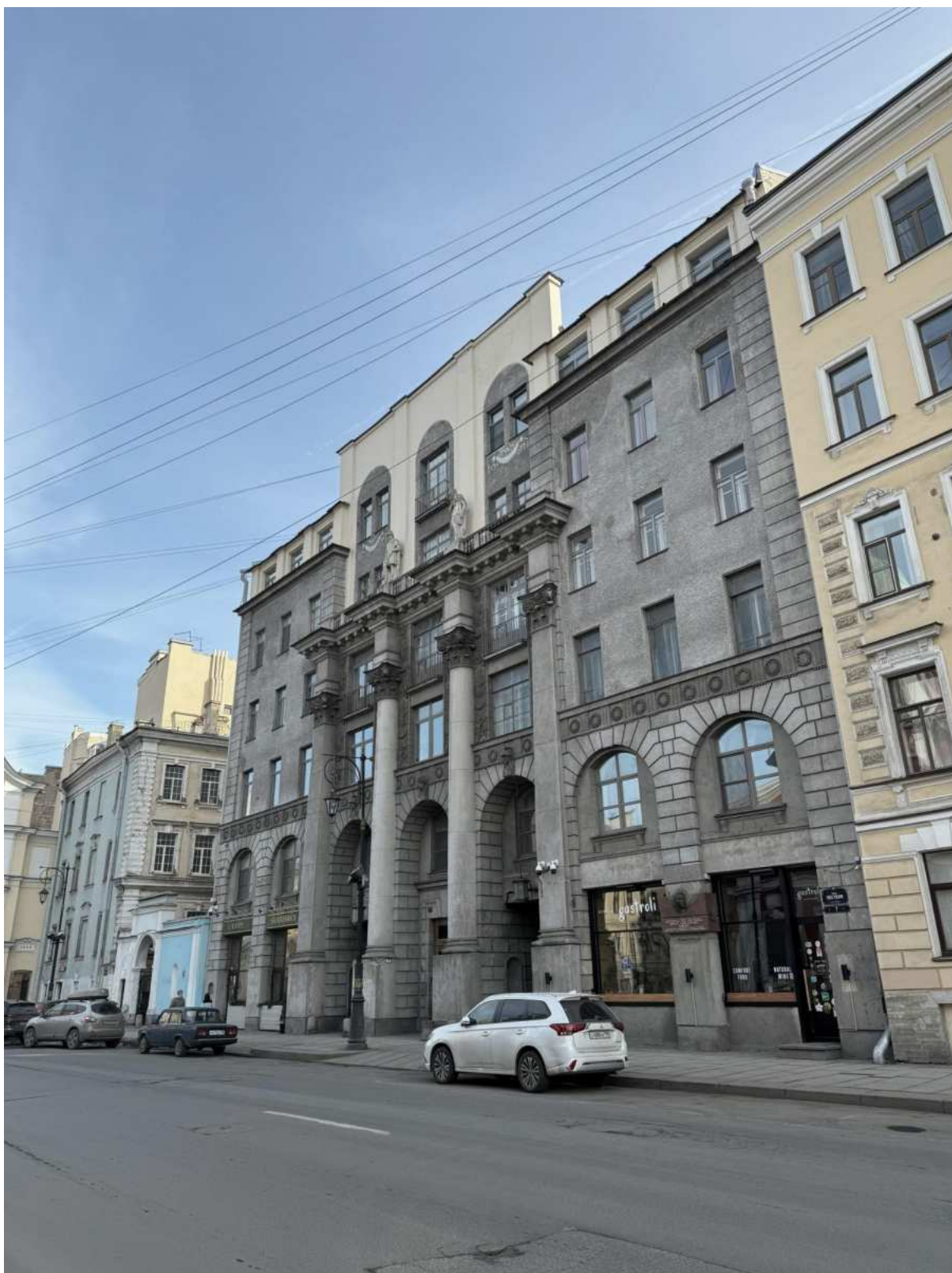
2. Общий вид лицевого фасада объекта культурного наследия на улице Пестеля.
