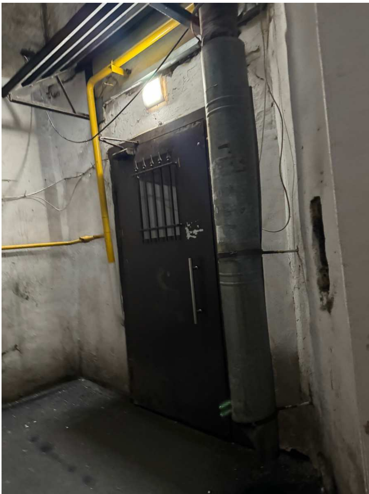
129. Вход в парадную лестницы 5ЛК объекта культурного наследия.
