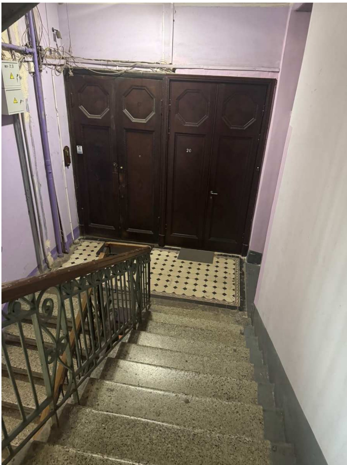
57. Общий вид лестницы 2ЛК объекта культурного наследия.
