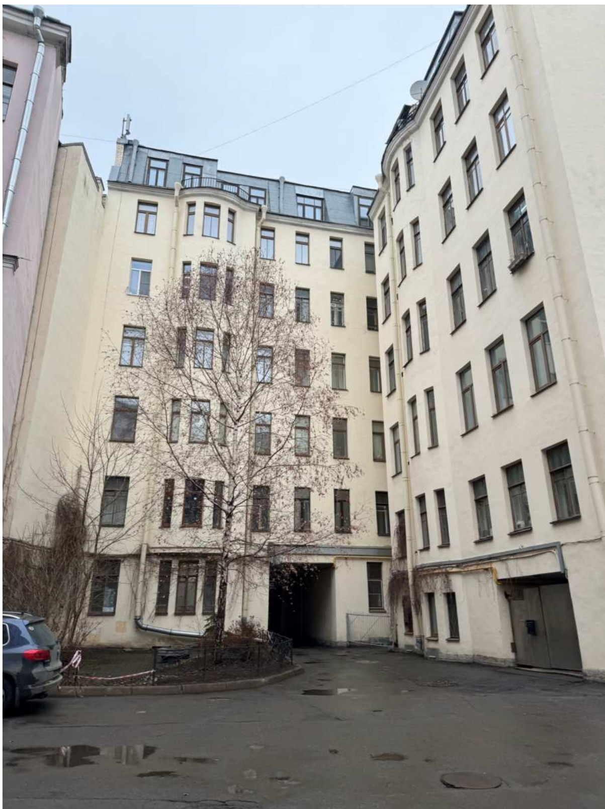
15. Дворовые фасады южного корпуса объекта культурного наследия.
