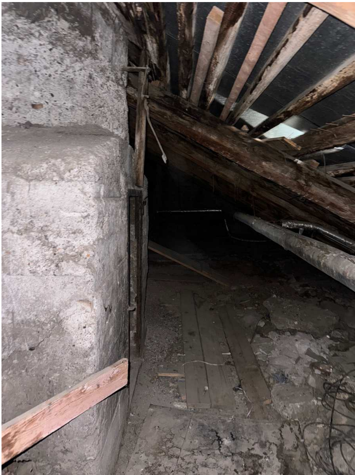
122. Общий вид чердачного помещения в части лестницы 4ЛК объекта культурного наследия.
