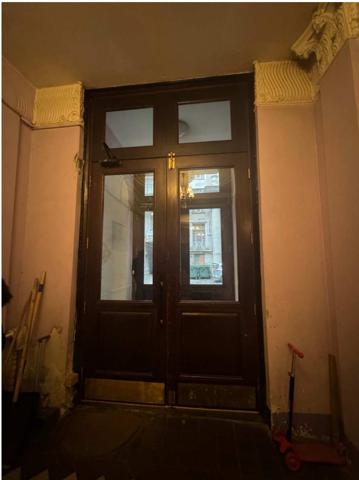
49. Вид на тамбур лестницы 2ЛК объекта культурного наследия.
