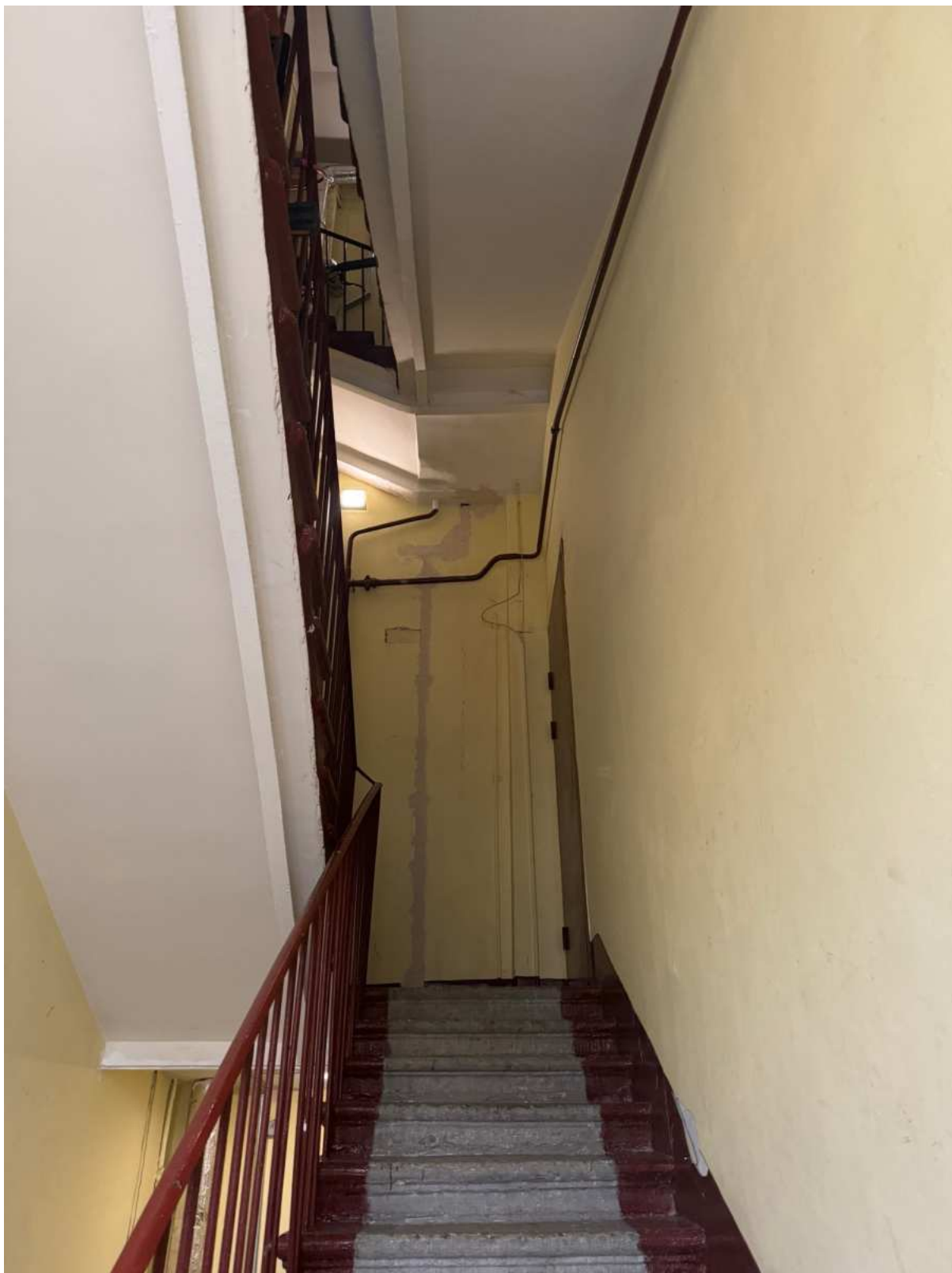
111. Общий вид лестницы 4ЛК объекта культурного наследия.
