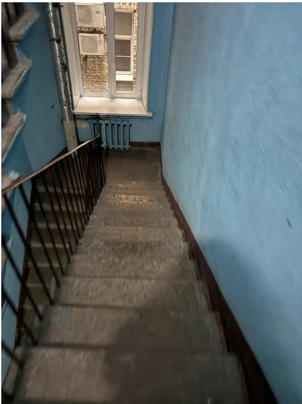
141. Общий вид лестницы 5ЛК объекта культурного наследия.
