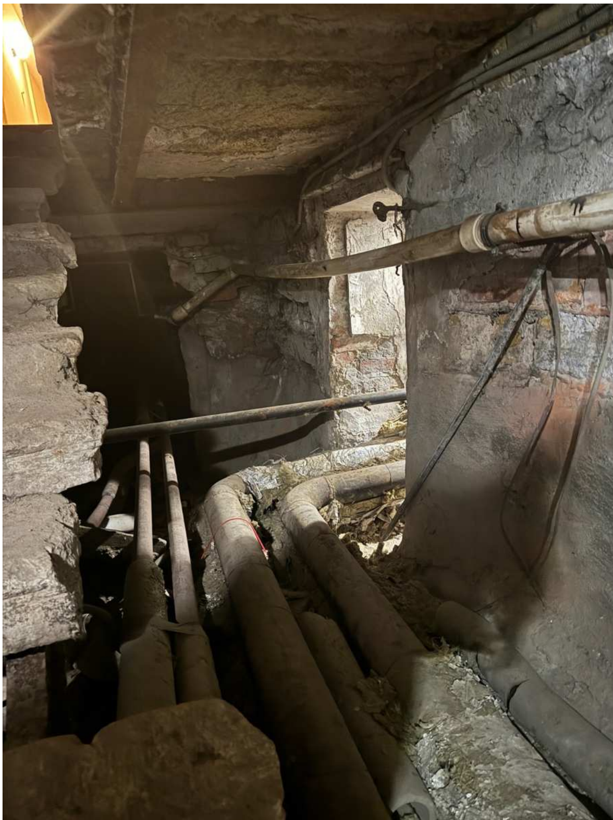
73. Интерьер подвальных помещений в части лестницы ЗЛК объекта культурного наследия.
