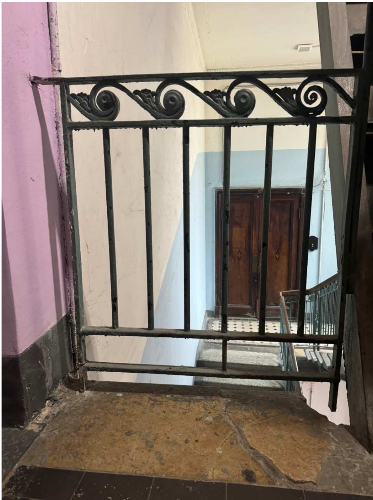
67. Ограждение лестницы 2ЛК объекта культурного наследия.
