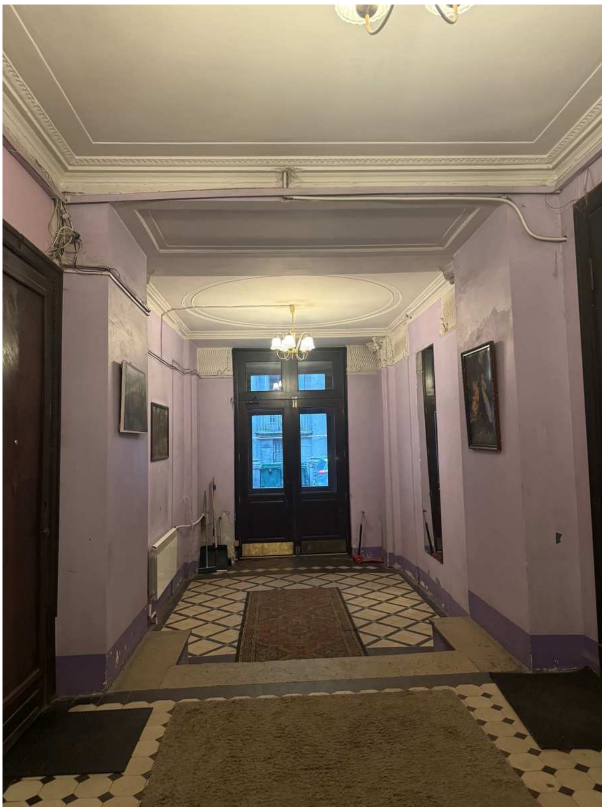
52. Интерьер вестибюля лестницы 2ЛК объекта культурного наследия.
