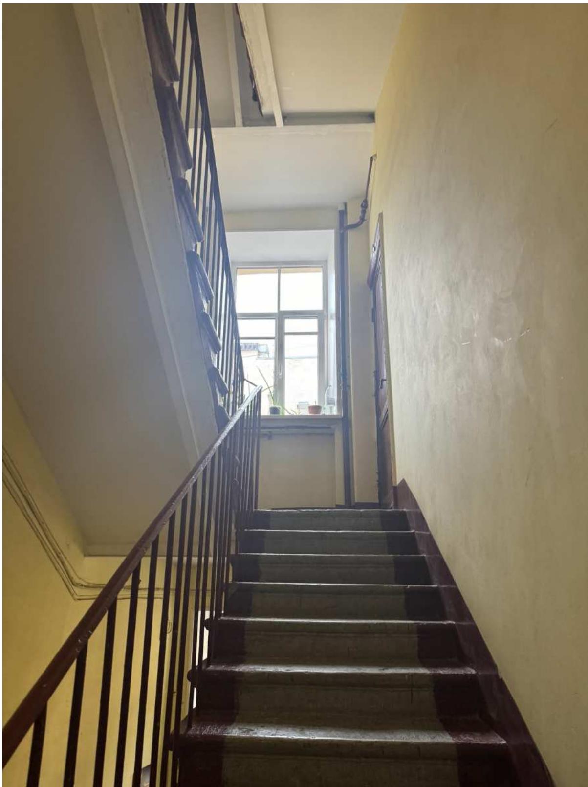
105. Общий вид лестницы 4ЛК объекта культурного наследия.
