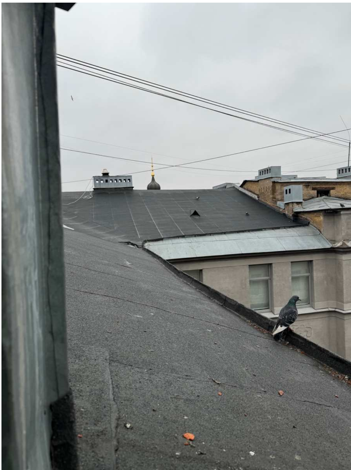
153. Вид на крышу объекта культурного наследия.
