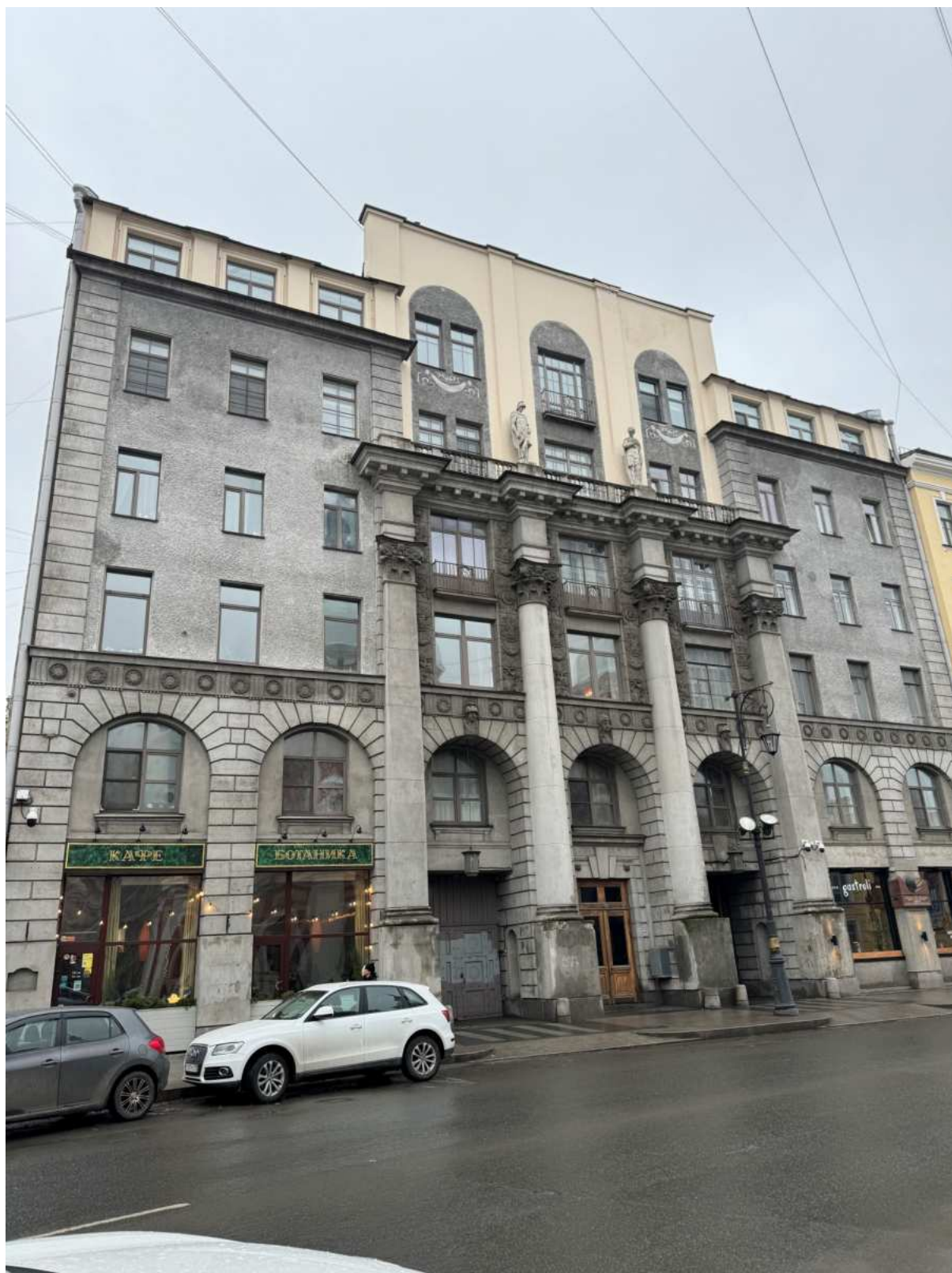
1. Общий вид лицевого фасада объекта культурного наследия на улице Пестеля.
