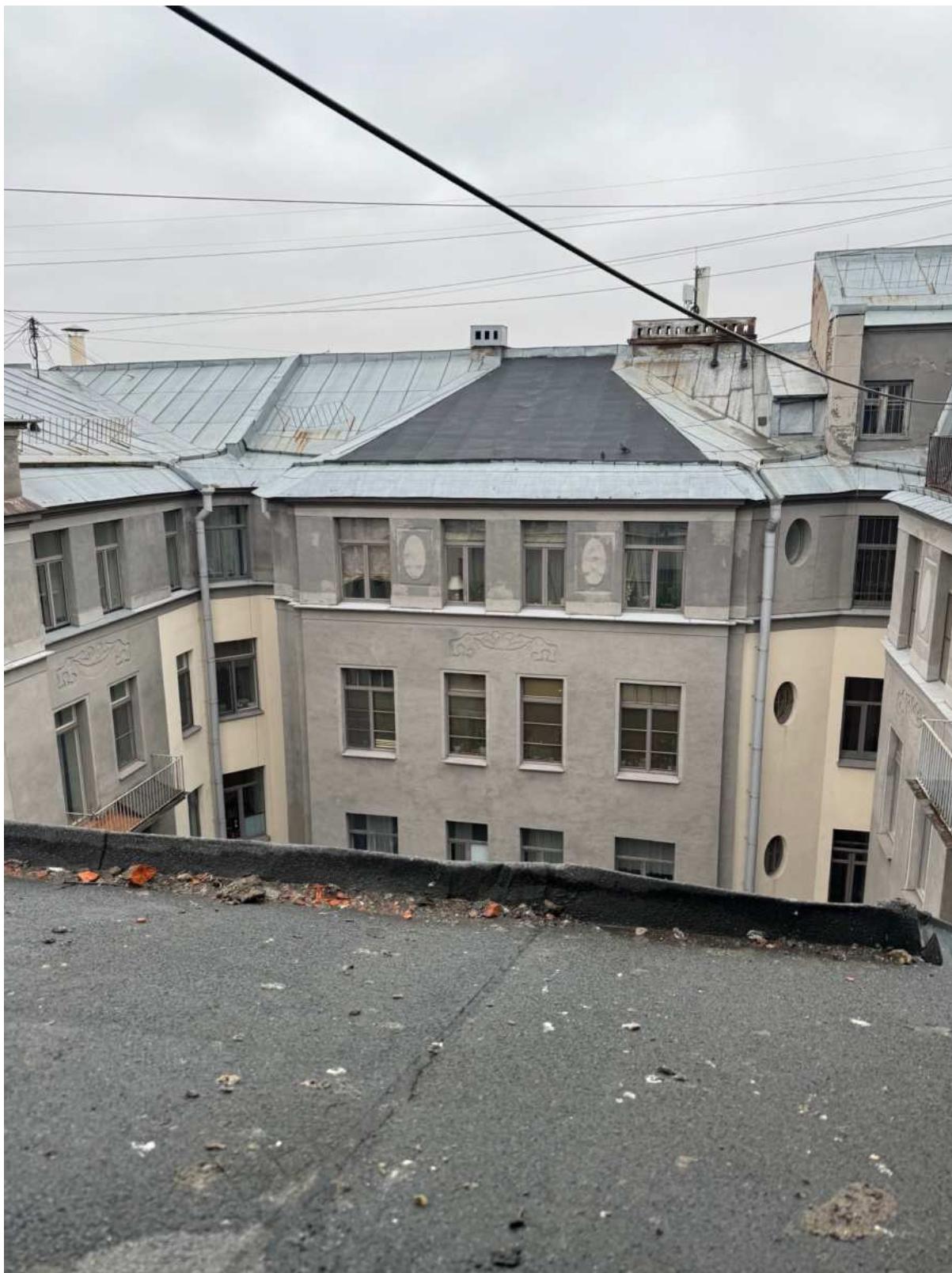
154. Вид на крышу объекта культурного наследия.
