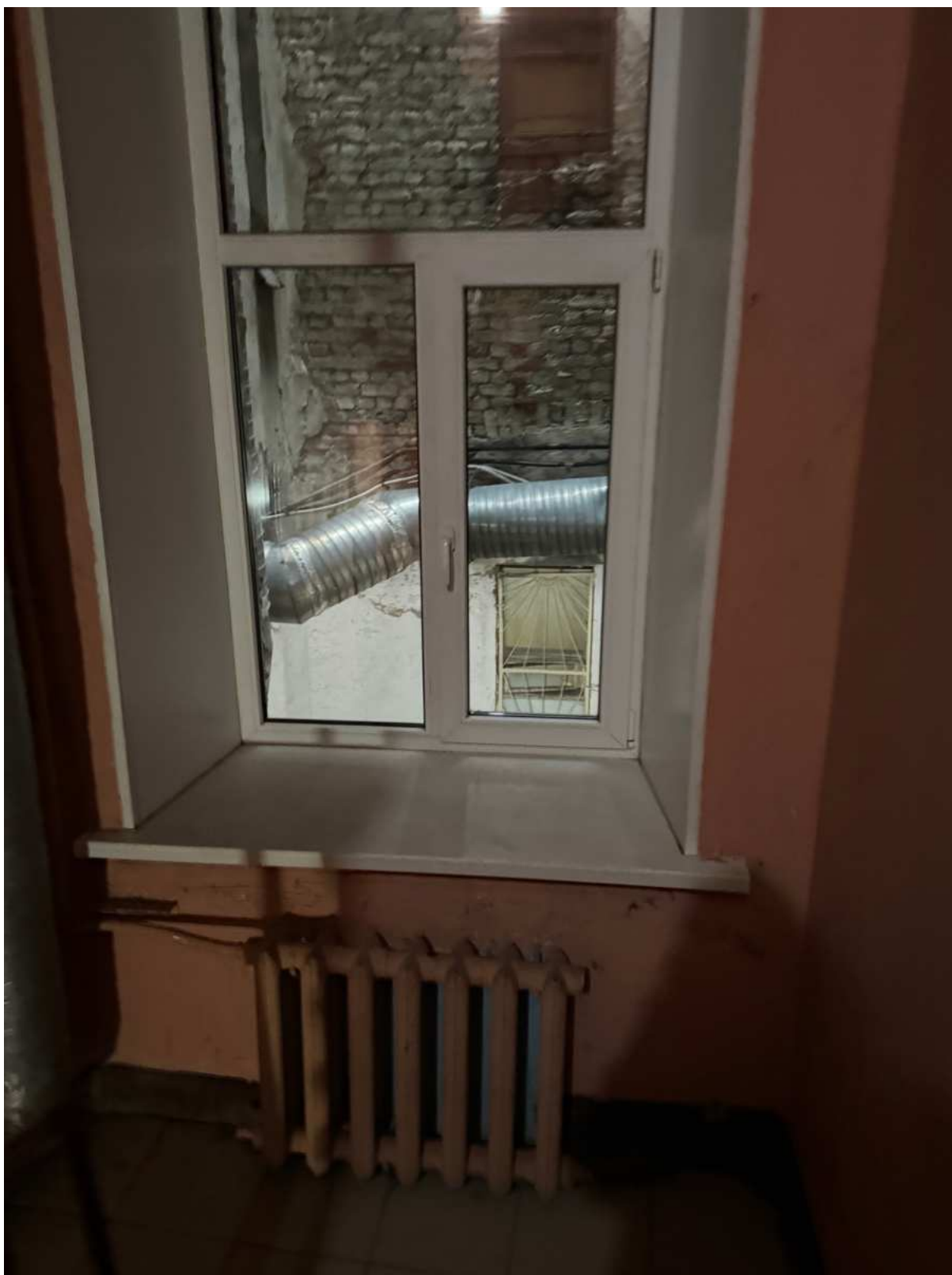
135. Оконное заполнение лестницы 5ЛК объекта культурного наследия.
