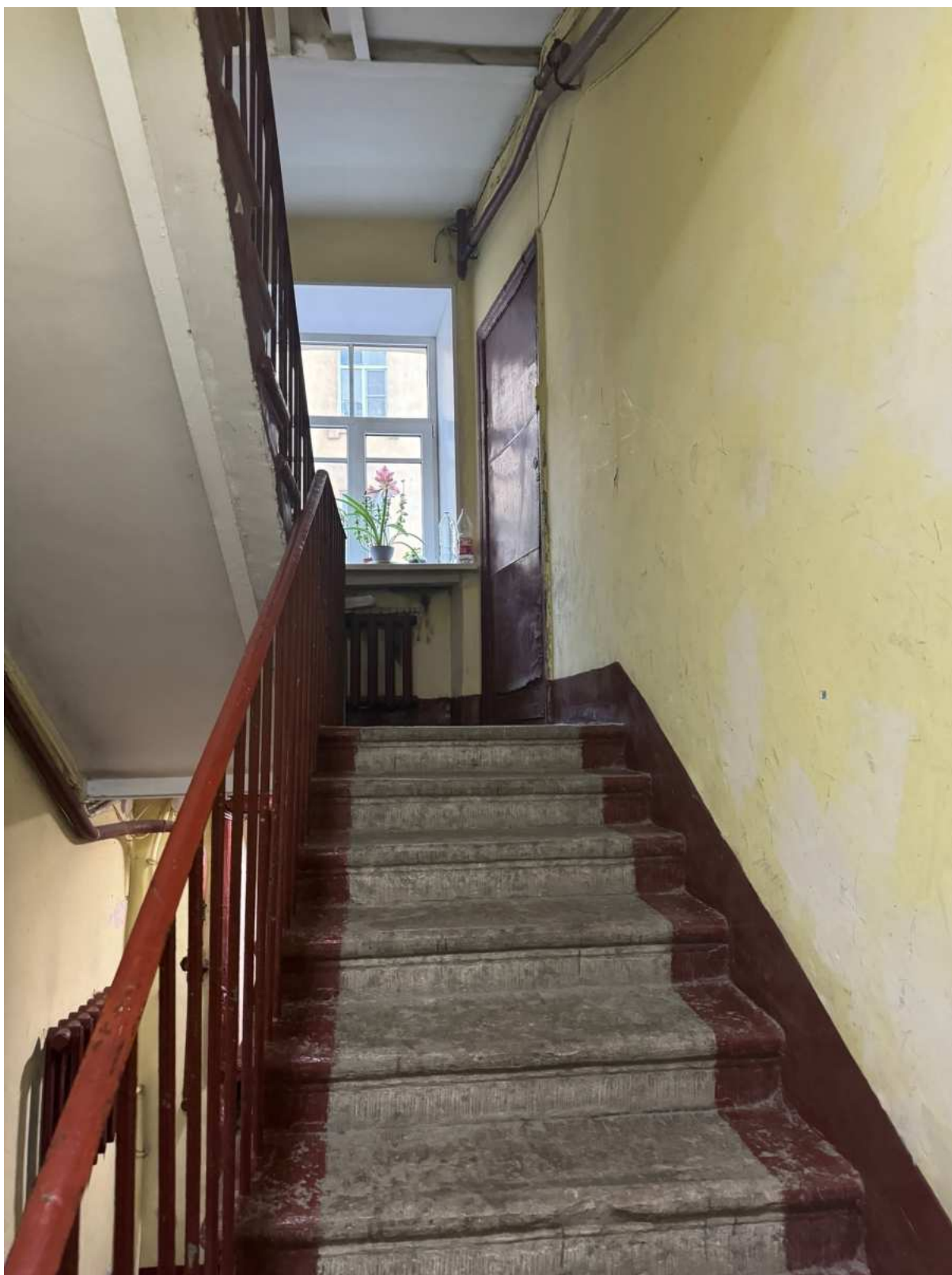
102. Общий вид лестницы 4ЛК объекта культурного наследия.
