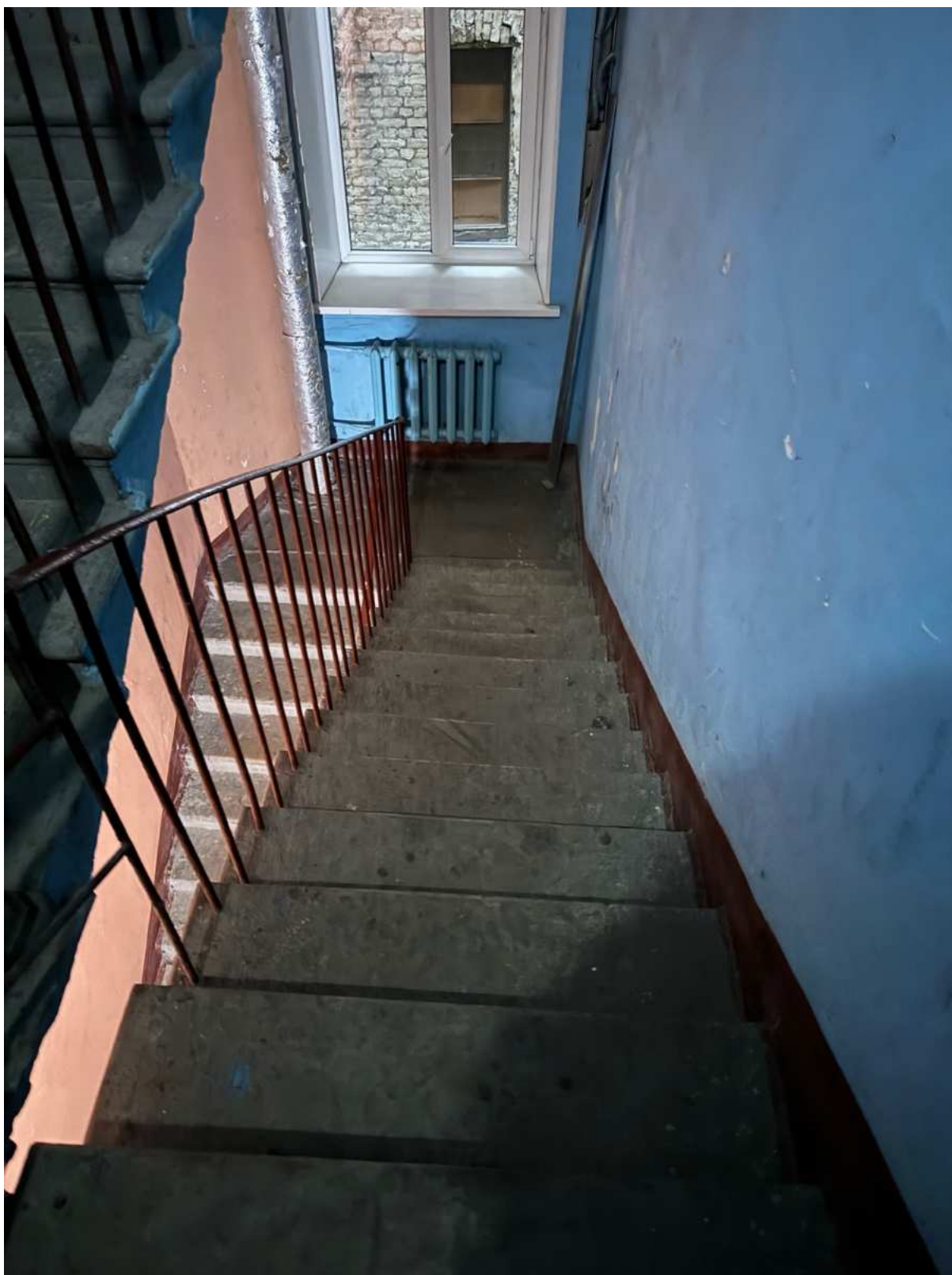
138. Общий вид лестницы 5ЛК объекта культурного наследия.
