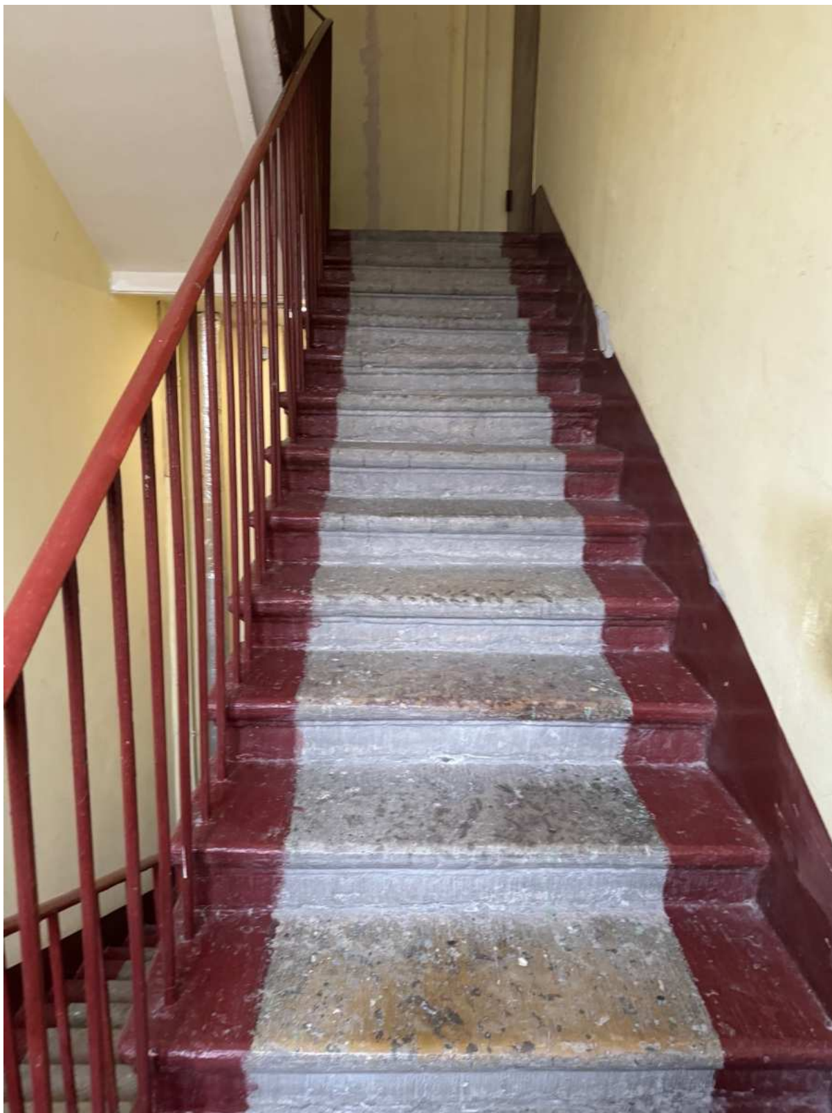
110. Общий вид лестницы 4ЛК объекта культурного наследия.
