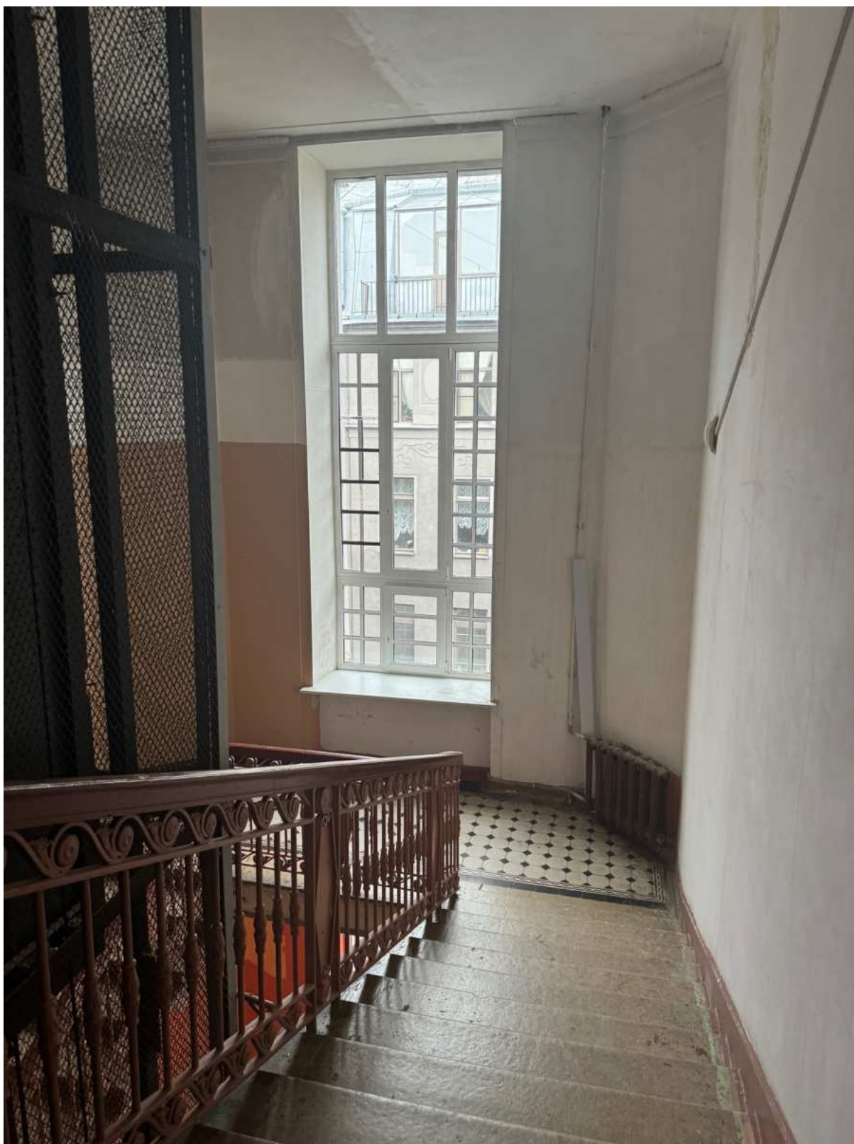
44. Общий вид лестницы 1ЛК объекта культурного наследия.
