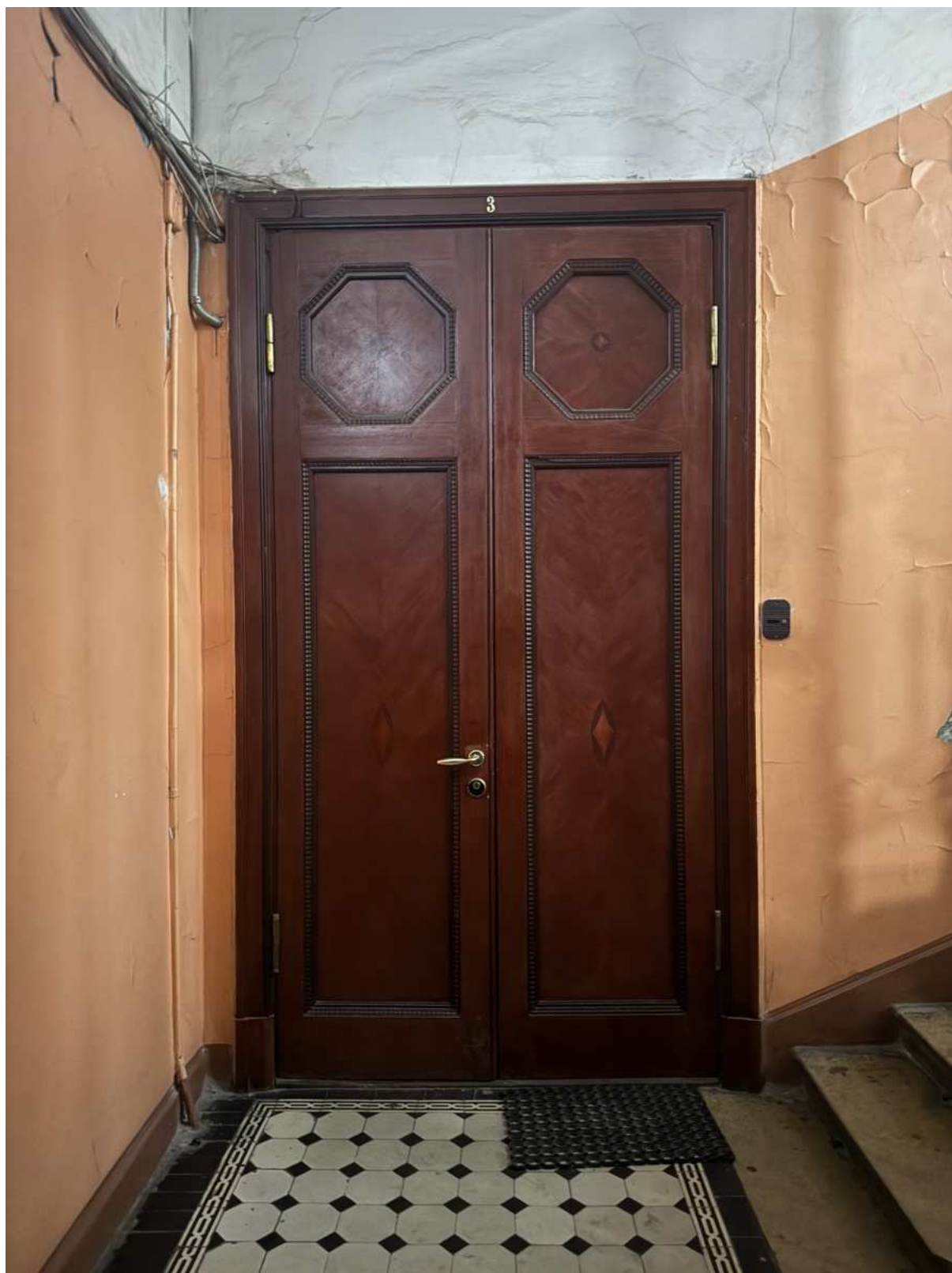
34. Общий вид лестницы 1ЛК объекта культурного наследия.
