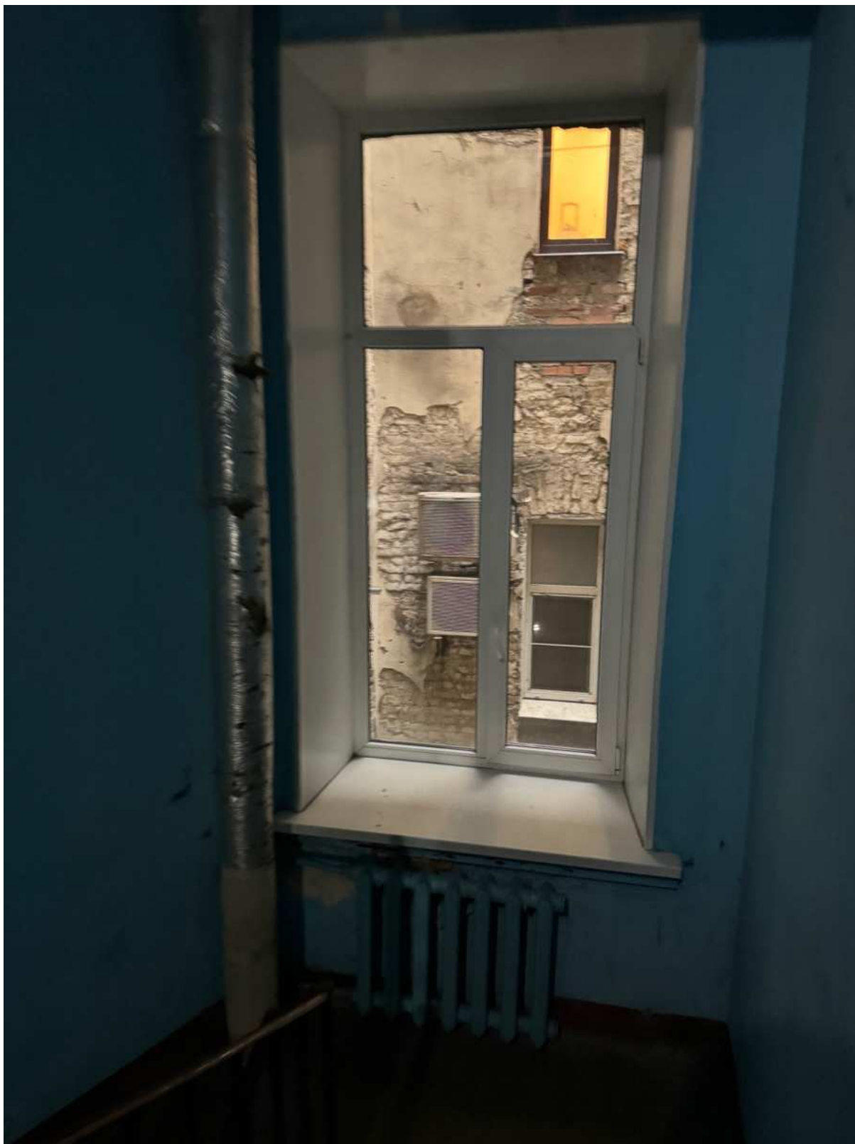
140. Оконное заполнение лестницы 5ЛК объекта культурного наследия.
