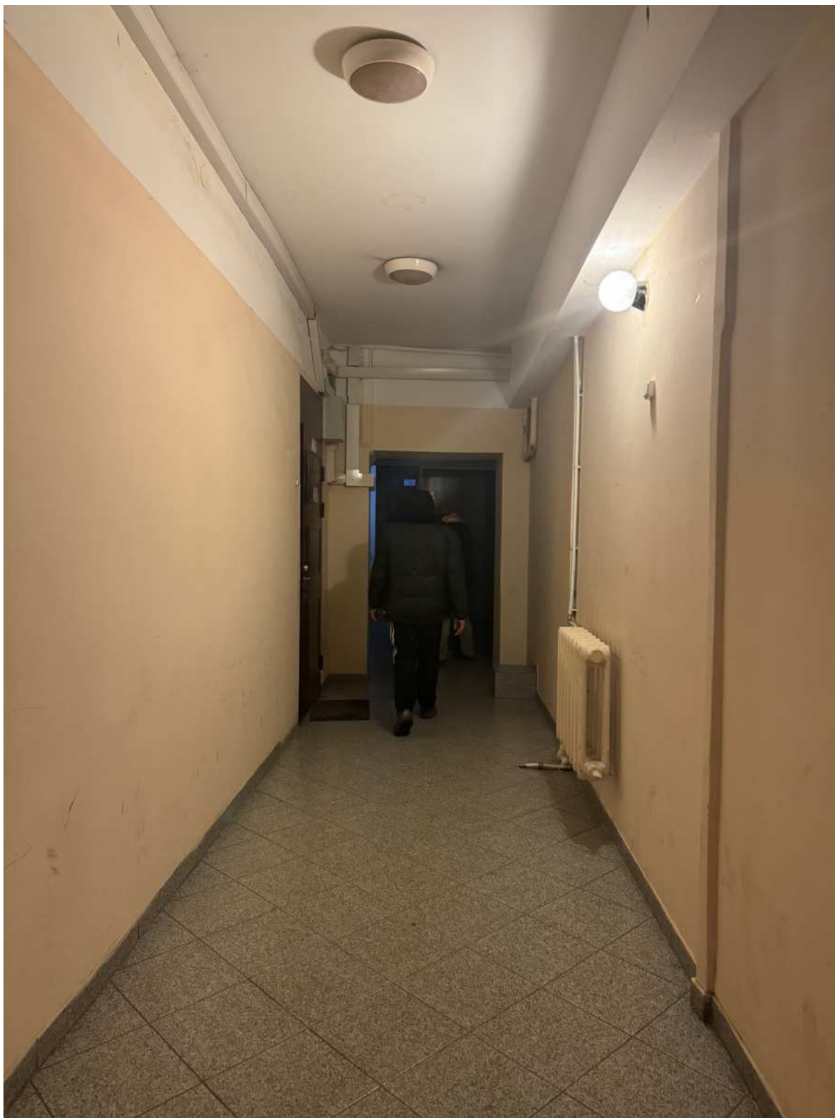
70. Интерьер помещений лестницы ЗЛК объекта культурного наследия.
