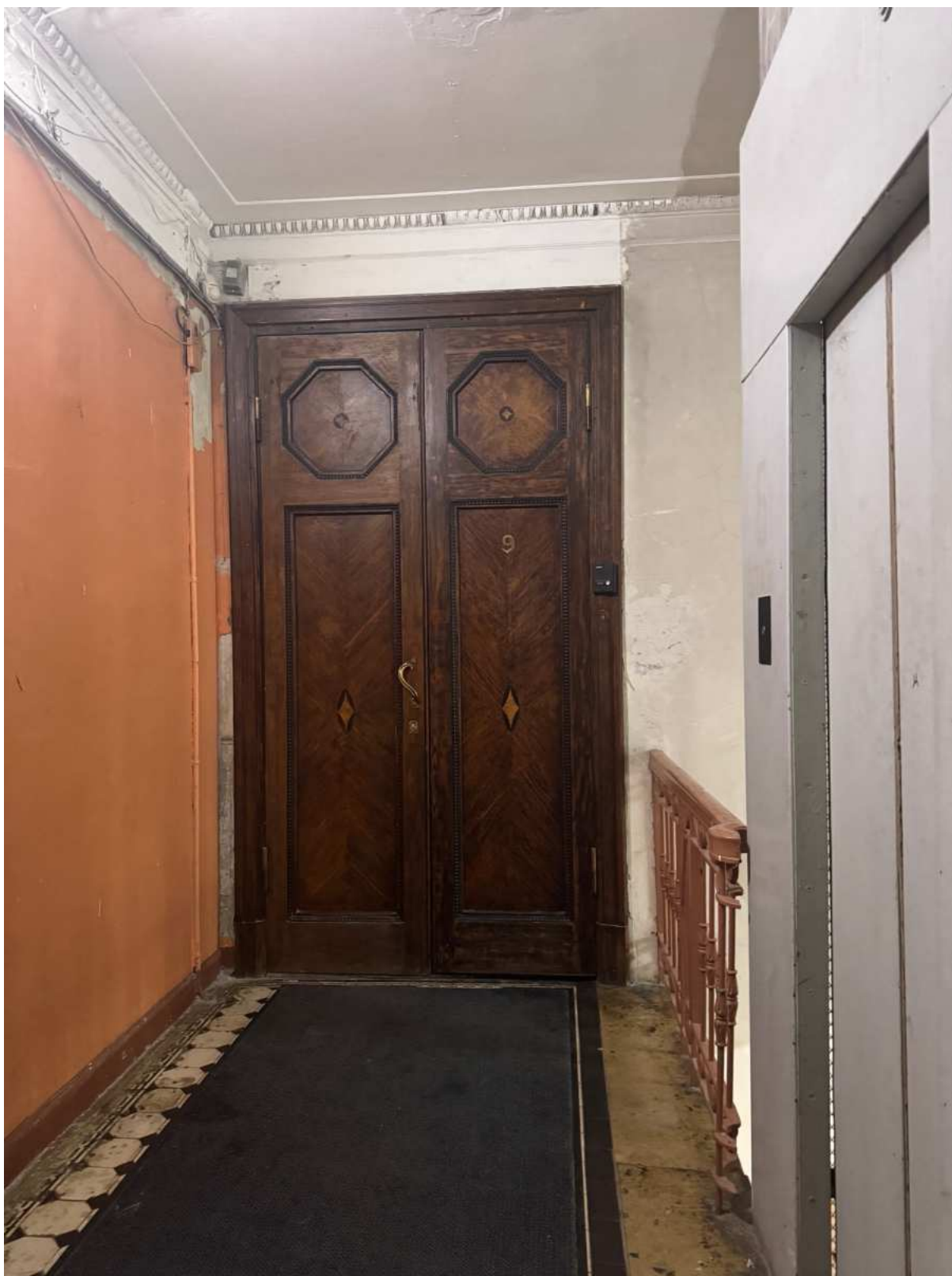
43. Общий вид лестницы 1ЛК объекта культурного наследия.
