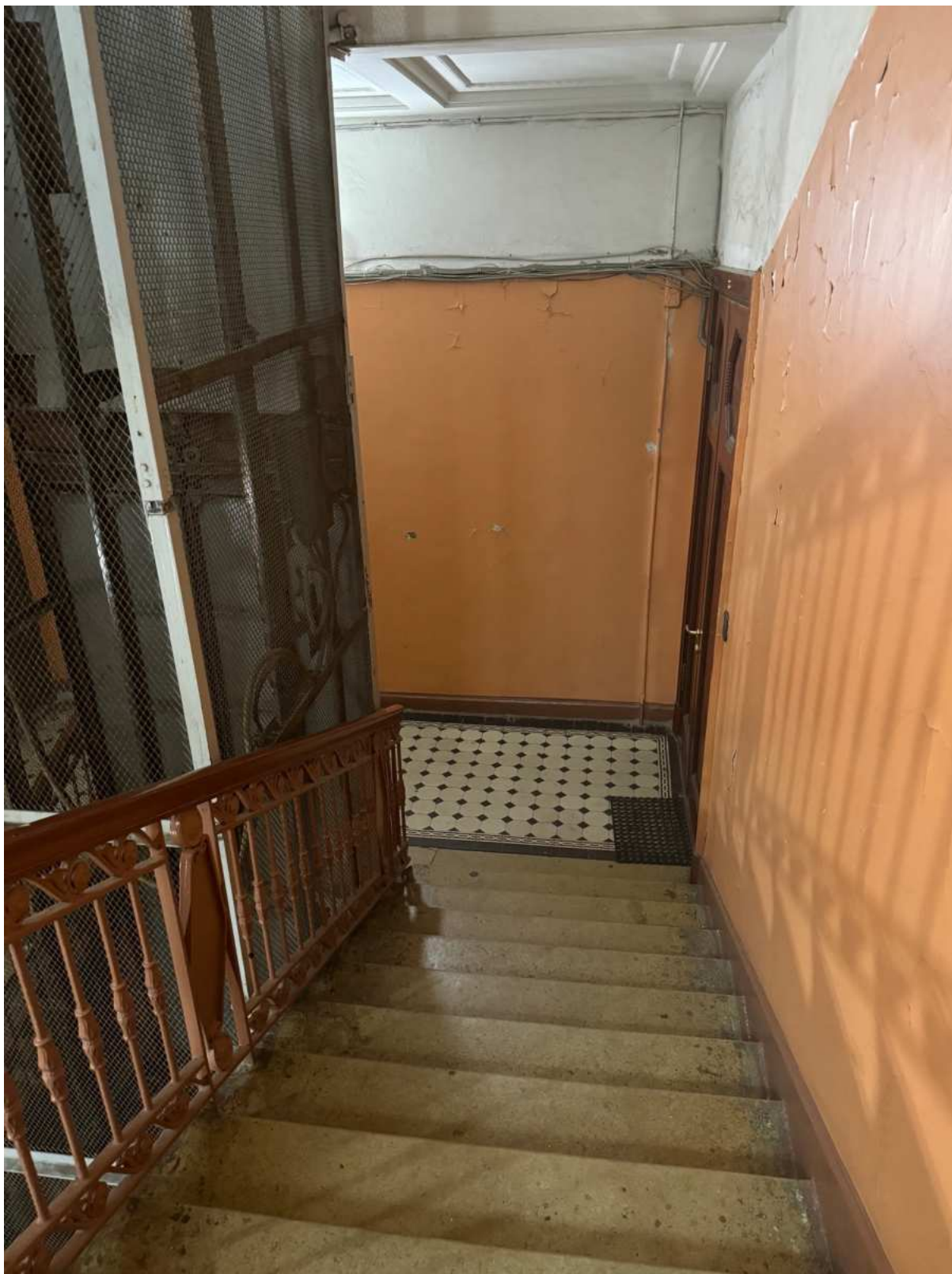
35. Общий вид лестницы 1ЛК объекта культурного наследия.
