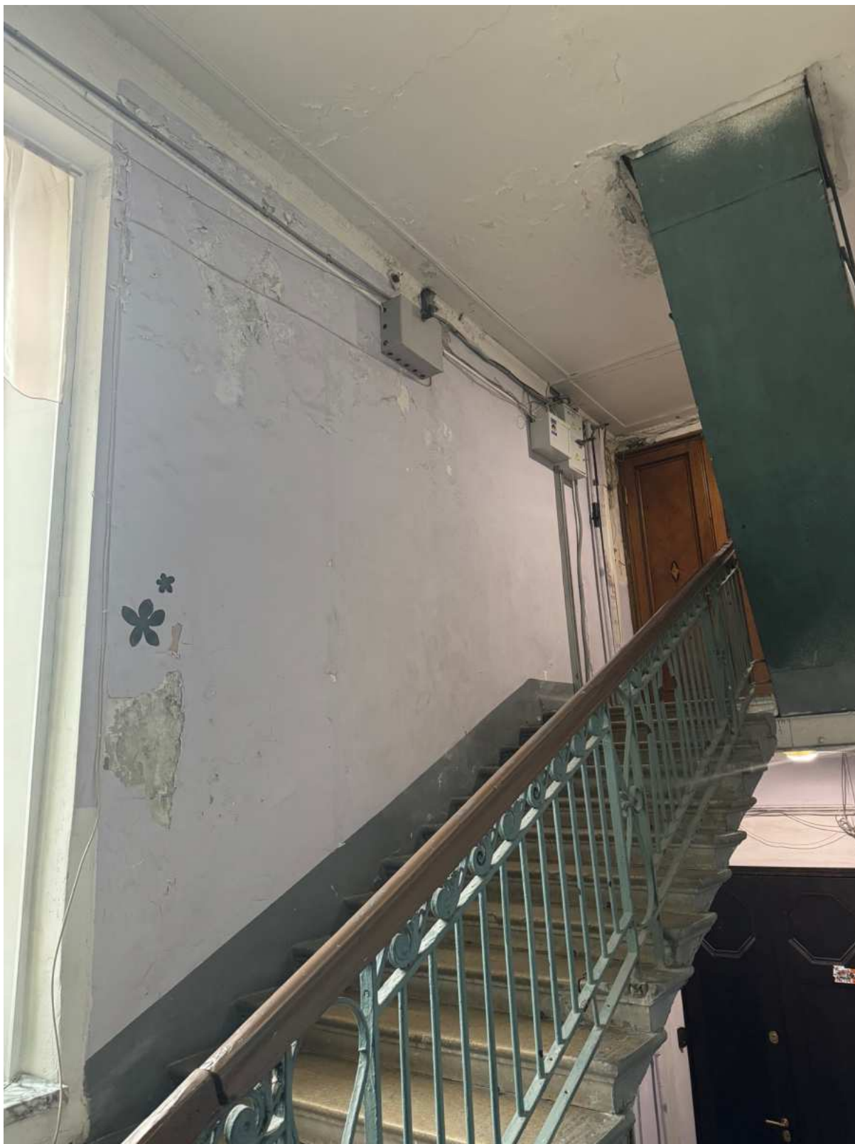
64. Общий вид лестницы 2ЛК объекта культурного наследия.
