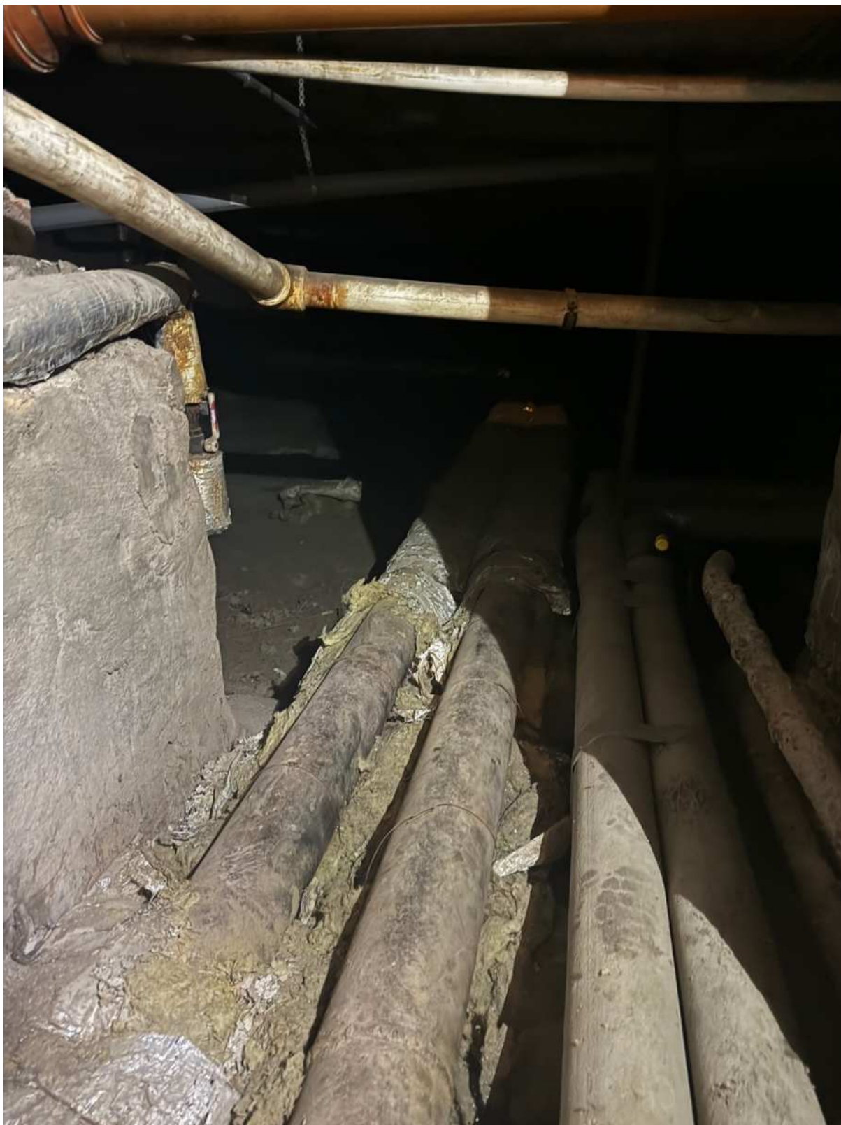
74. Интерьер подвальных помещений в части лестницы ЗЛК объекта культурного наследия.
