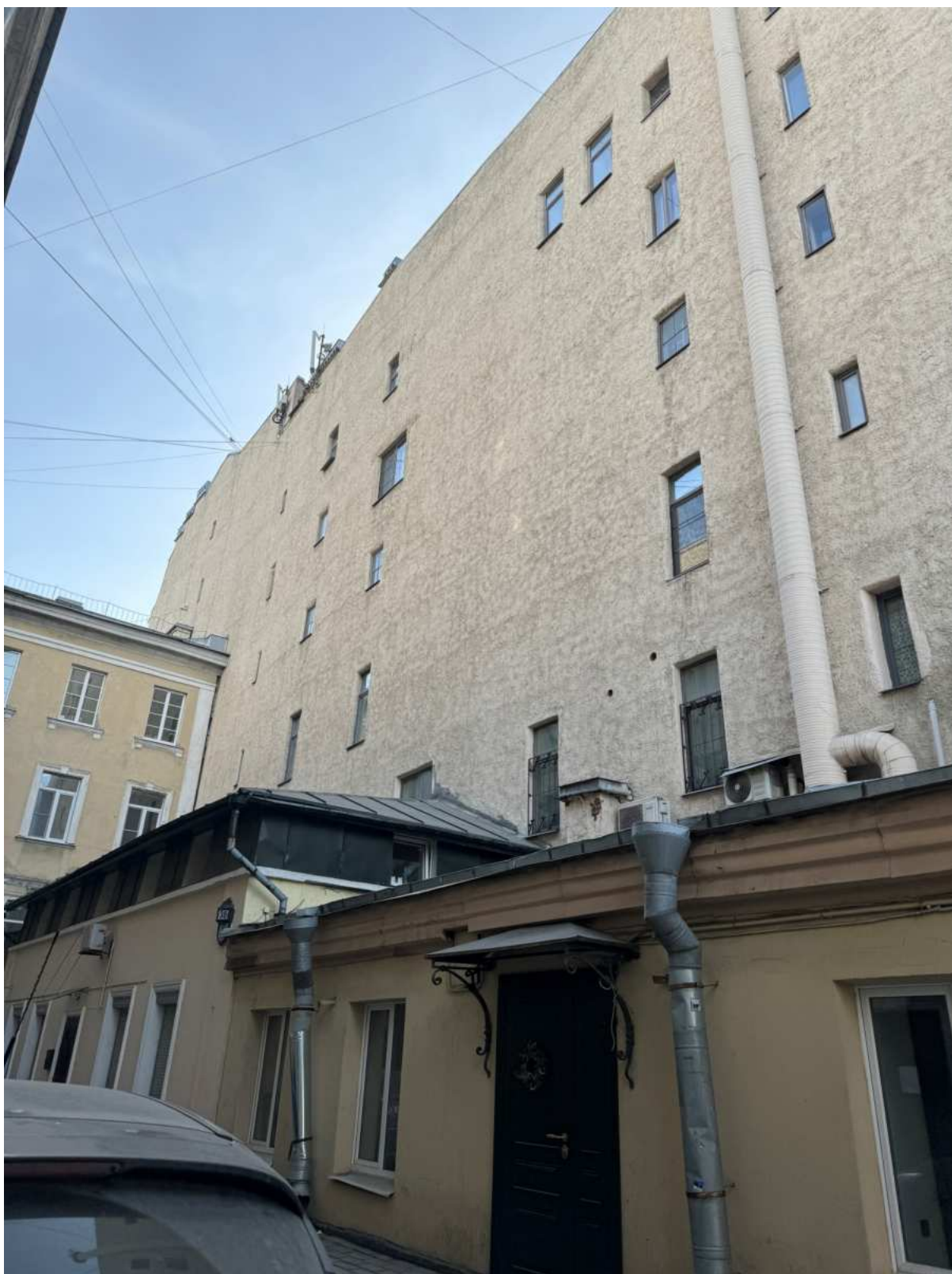
6. Фрагмент восточного брандмауэрного фасада объекта культурного наследия.
