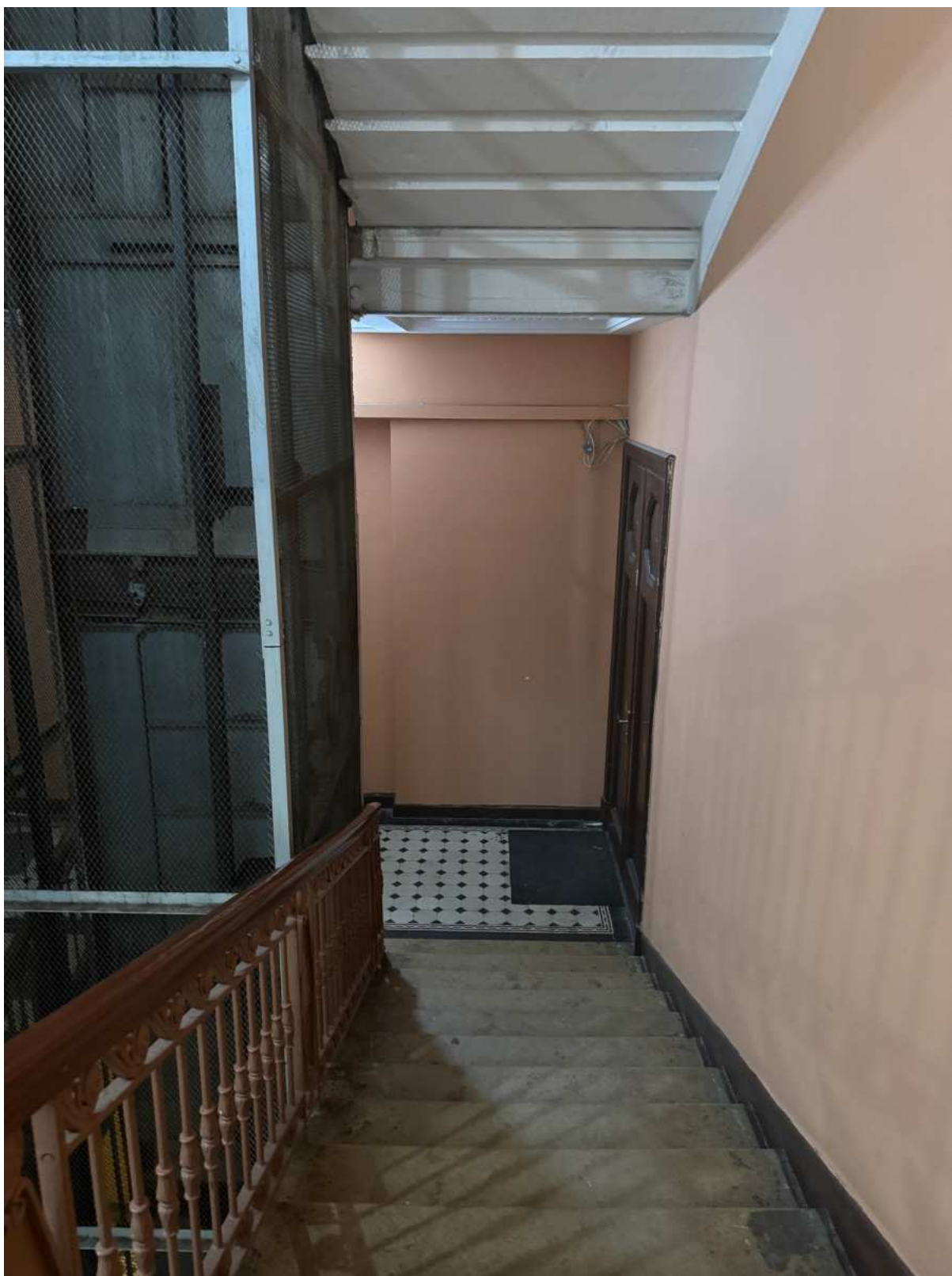
31. Общий вид лестницы 1ЛК объекта культурного наследия.
