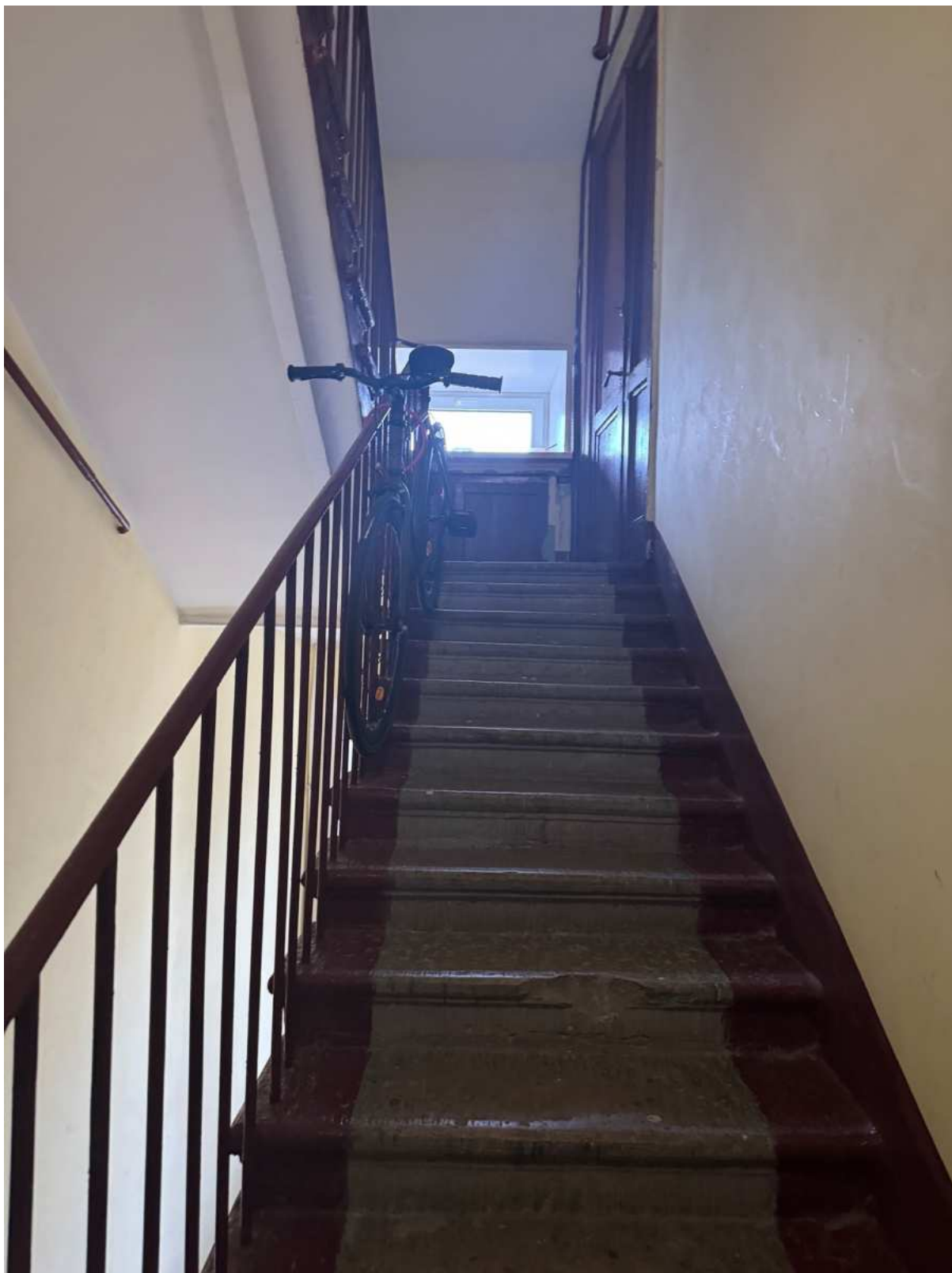
112. Общий вид лестницы 4ЛК объекта культурного наследия.
