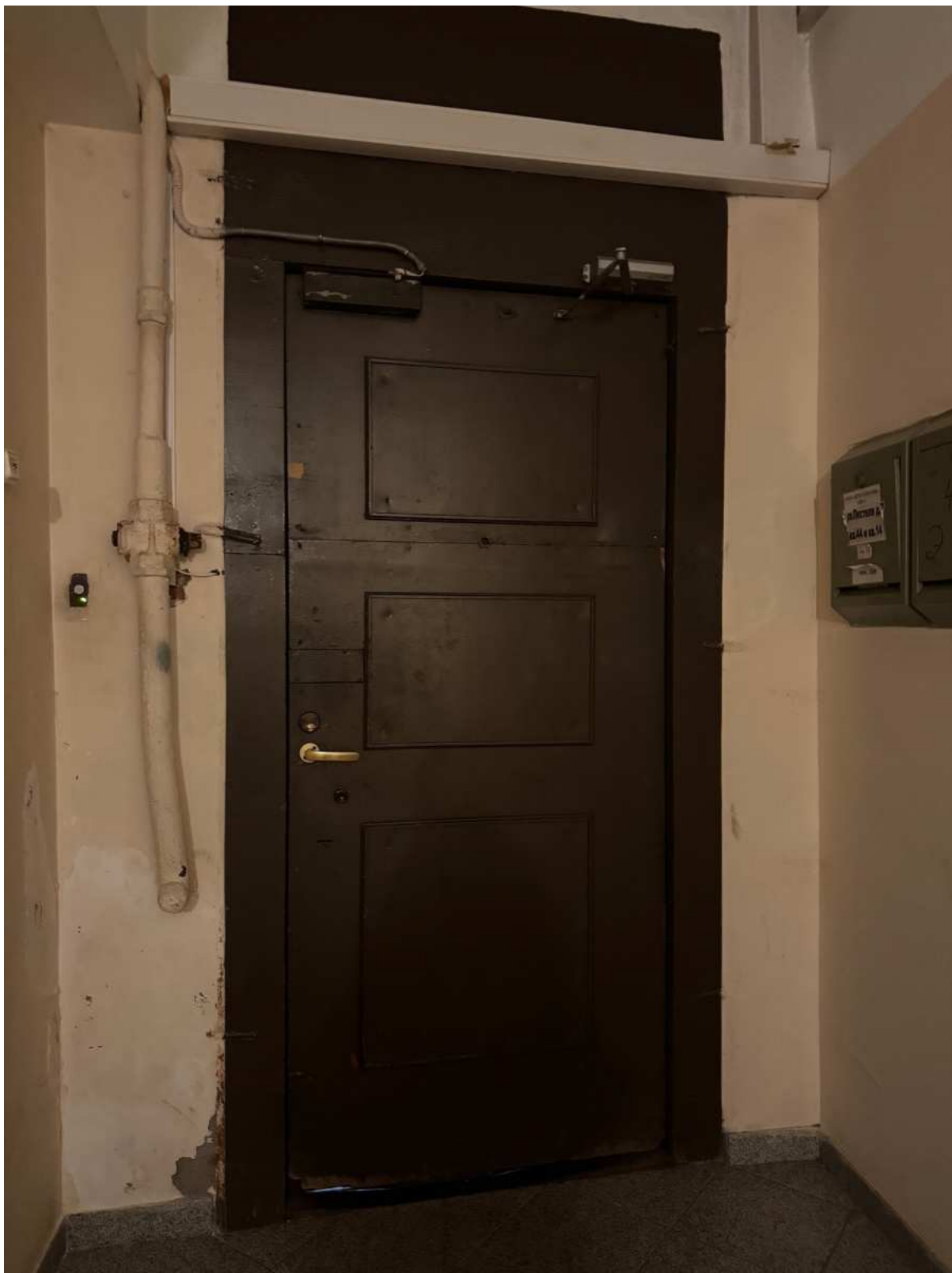
69. Интерьер помещений лестницы ЗЛК объекта культурного наследия.
