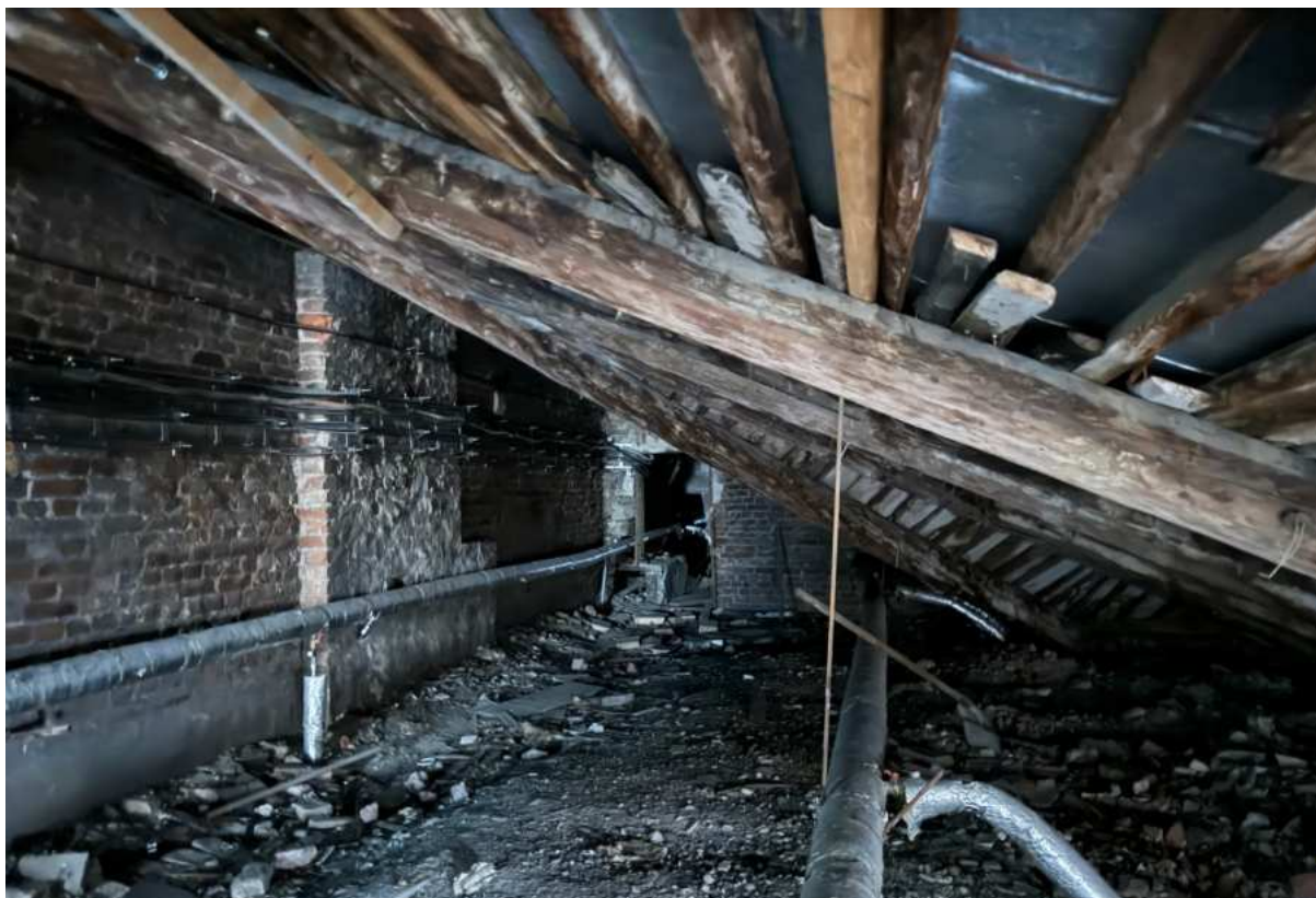
152. Общий вид чердачного помещения в части лестницы 5ЛК объекта культурного наследия.
