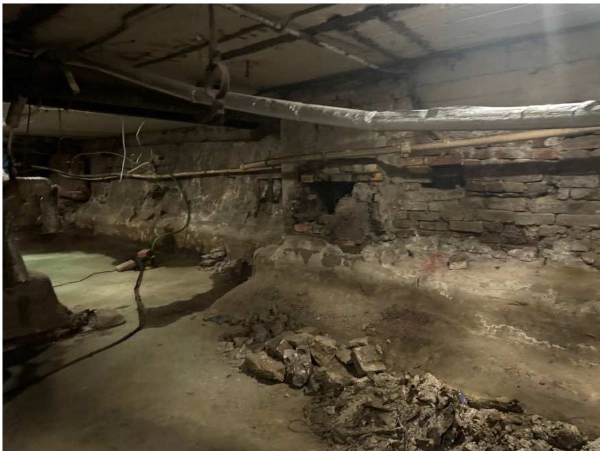
99. Общий вид подвального помещения в части лестницы 4ЛК объекта культурного наследия.
