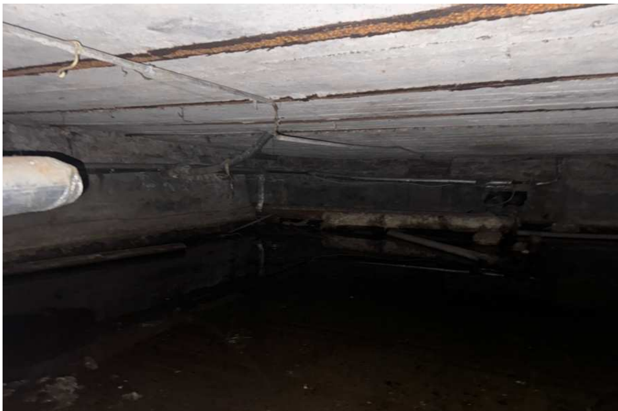
79. Интерьер подвальных помещений в части лестницы ЗЛК объекта культурного наследия.
