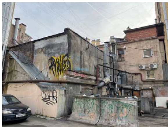
Дворовой фасад. Фото 04.03.2024 г.
