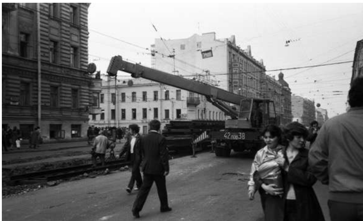
50 Ремонт путей на Среднем проспекте. 1982 – 1990 гг. [Электронный ресурс] URL: https://pastvu.com/p/915808
