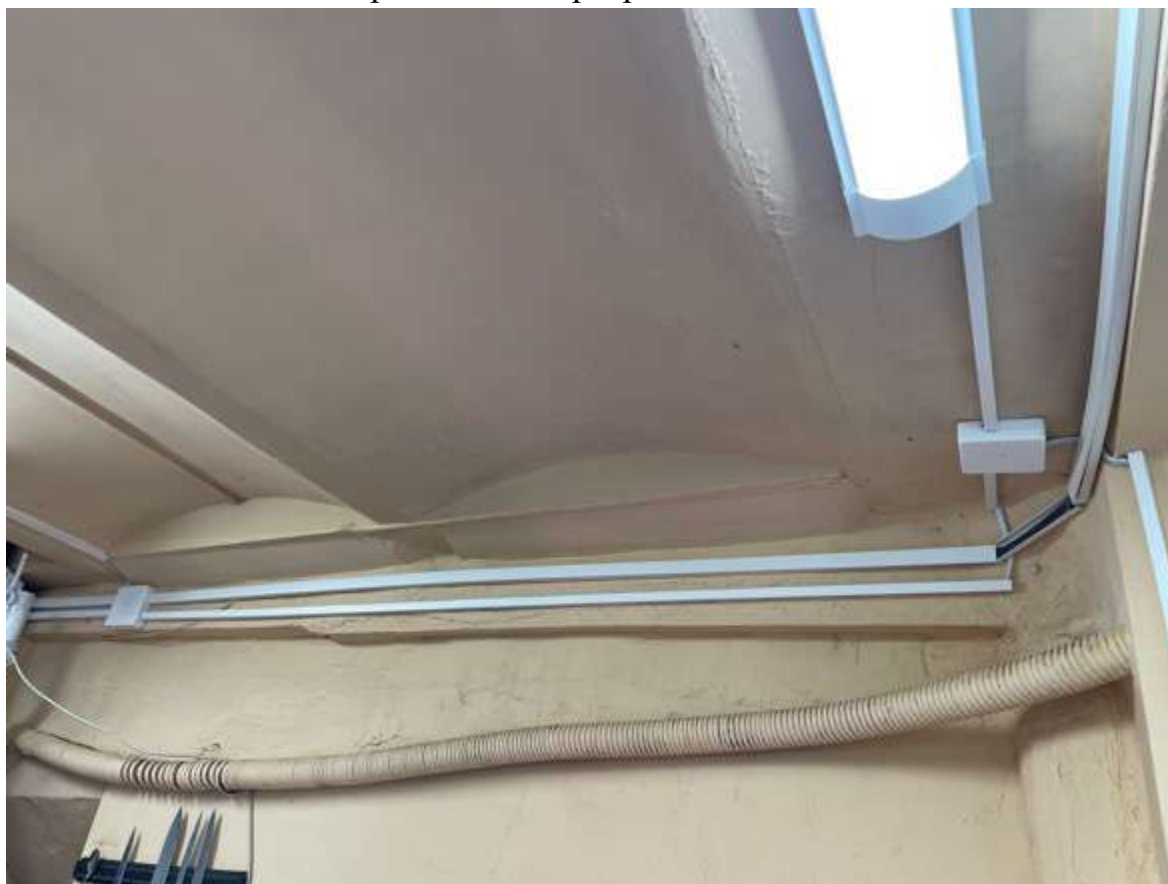
13. Фрагмент интерьера цокольного этажа
