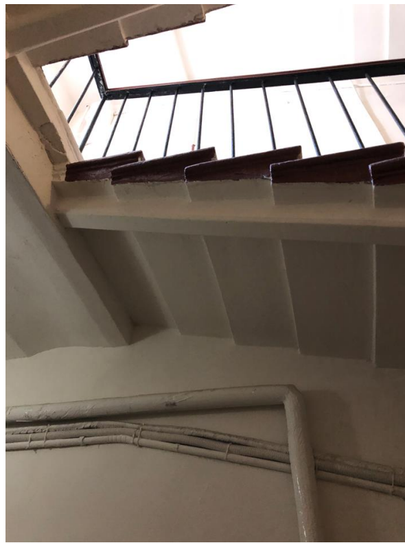
Фото 2. Лестница 5 ЛК литеры А.
