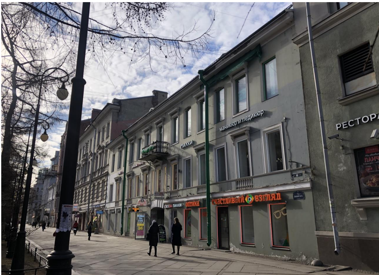
Фото 3. Лицевой фасад дома № 42 по 7-й линии.
