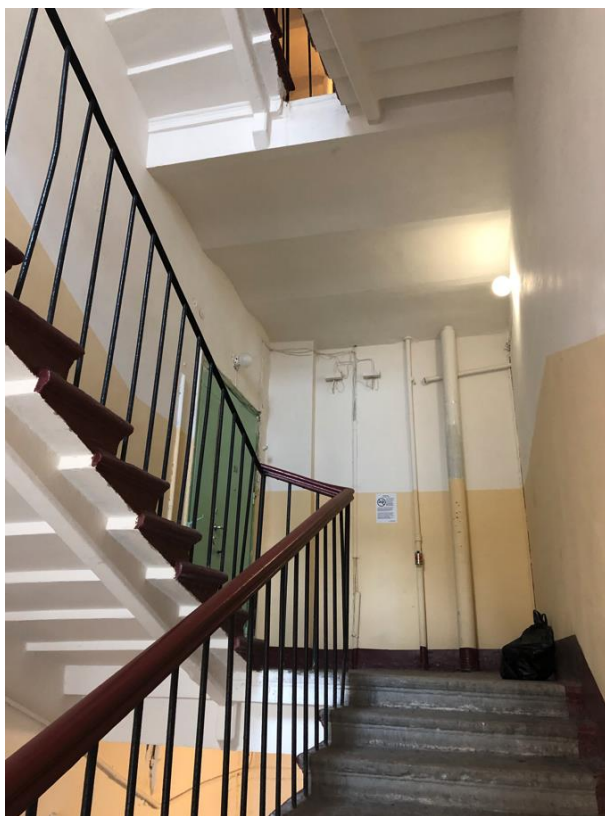
Фото 3. Лестница 5 ЛК литеры А.
