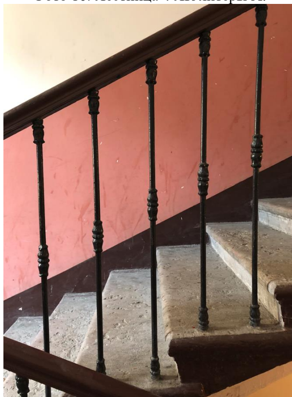
Фото 12. Лестница 4 ЛК литеры А.
