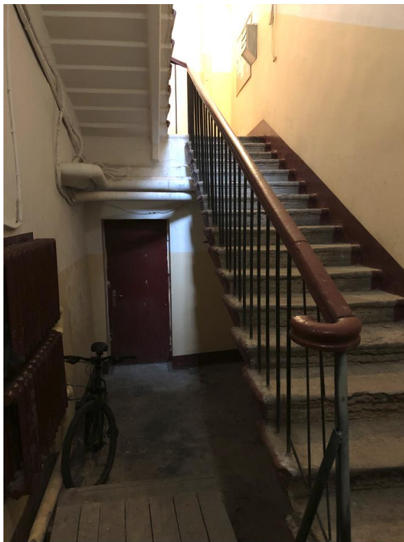
Фото 1. Лестница 5 ЛК литеры А.
