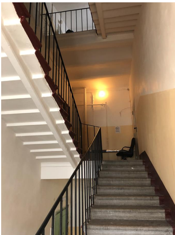
Фото 5. Лестница 5 ЛК литеры А.
