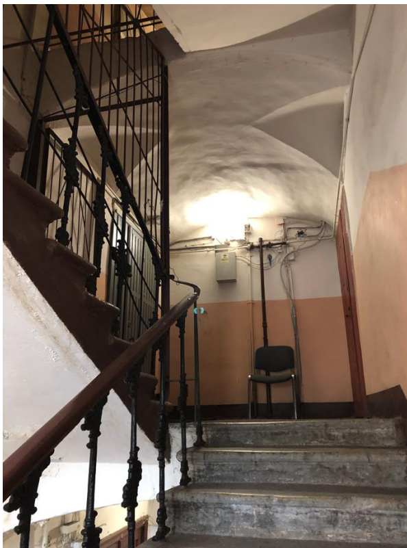
Фото 9. Лестница 1 ЛК литеры Г.
