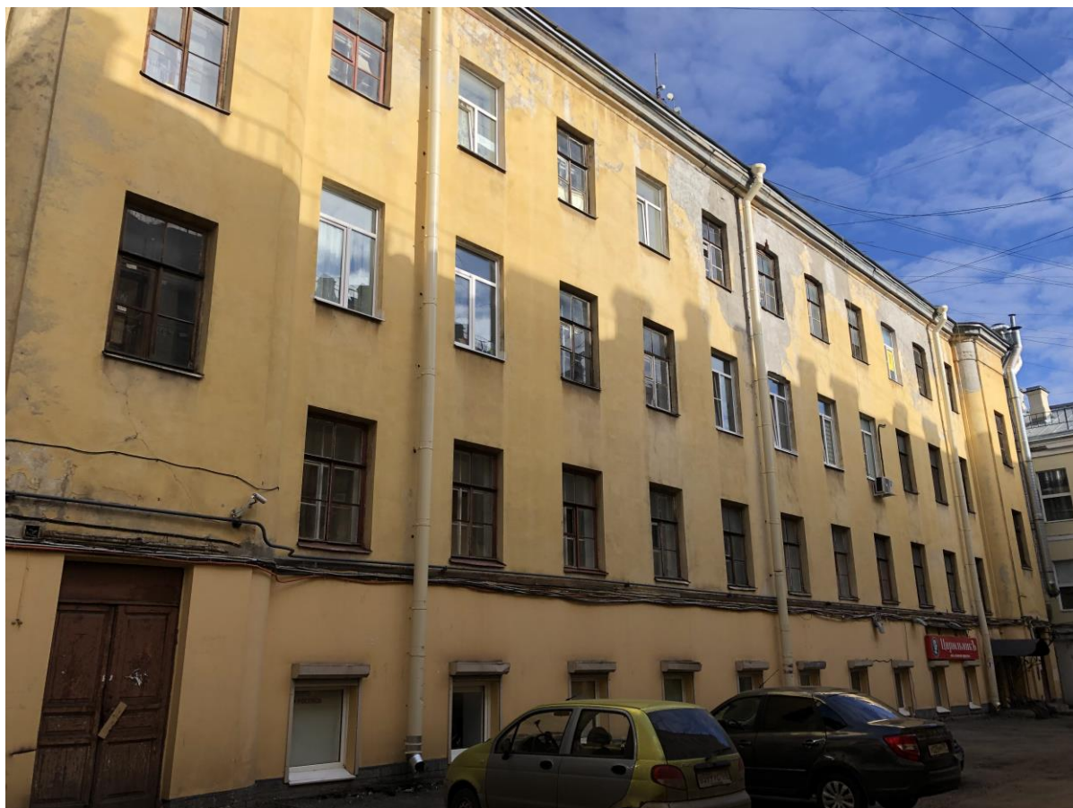
Фото 10. Вид на дворовый северо-западный флигель.
