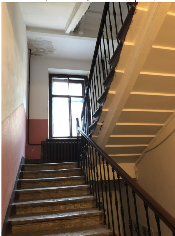
Фото 11. Лестница 4 ЛК литеры А.
