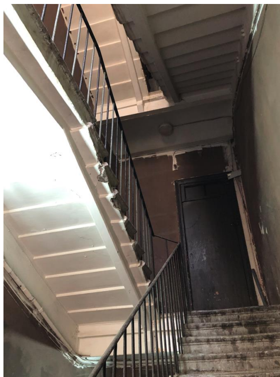
Фото 14. Лестница 3 ЛК литеры А.
