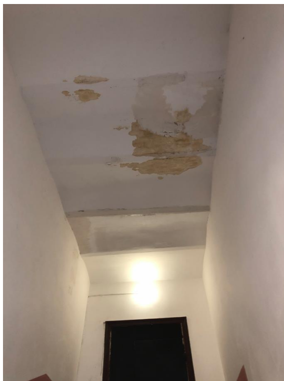
Фото 13. Лестница 4 ЛК литеры А.
