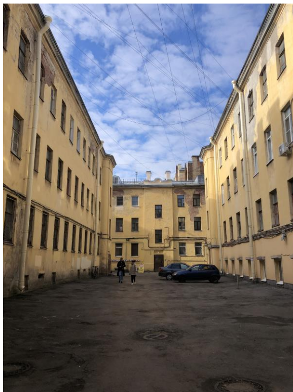
Фото 6. Вид на дворовые фасады.
