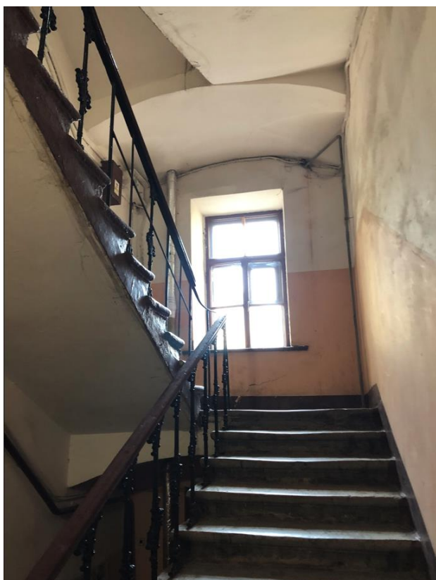
Фото 7. Лестница 1 ЛК литеры Г.
