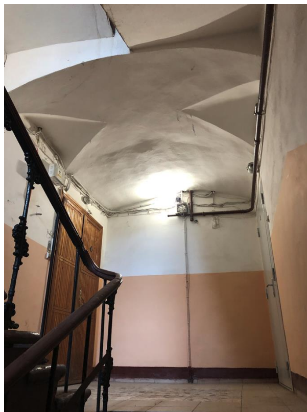
Фото 6. Лестница 1 ЛК литеры Г.
