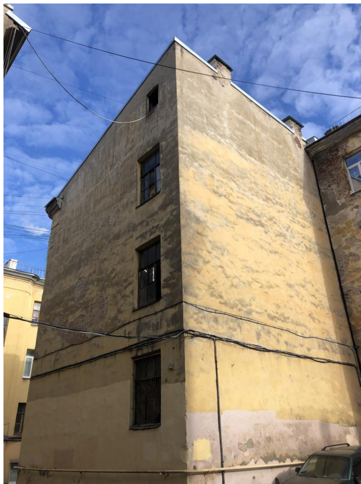
Фото 14. Угол дворового юго-восточного флигеля.
