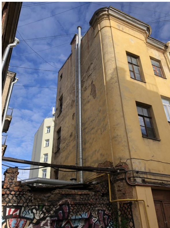
Фото 12. Вид на торцевой фасад северо-западного флигеля.
