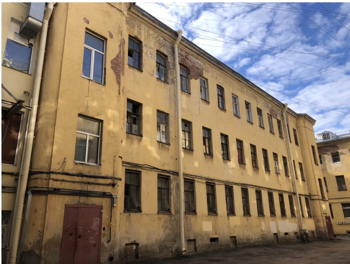
Фото 8. Вид на фасад юго-восточного дворового флигеля.
