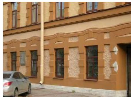
оформление оконных проемов: рустованные (муфтированные) наличники проемов 1-4-го этажей; выделенные оштукатуренные лучковые перемычки с замковыми камнями, оштукатуренные импосты проемов 1-го этажа; веерные перемычки проемов 3-го этажа;
