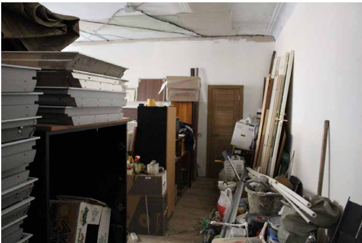
Фото 36. Восточный жилой корпус (ул. Комиссара Смирнова, д. 15, лит. Б) выявленного объекта культурного наследия «Жилой дом Выборгского товарищества для устройства постоянных квартир (Дворец культуры «Выборгский» с двумя жилыми корпусами)». Квартира № 40, вид на объединенные помещения №№ 1, 2, 3, 4.
