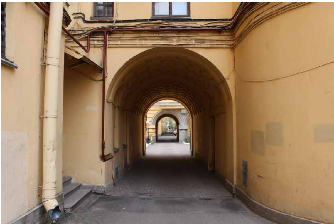
Фото 17. Арка воротного проезда в восточном жилом корпусе (ул. Комиссара Смирнова, д. 15, лит. Б) выявленного объекта культурного наследия «Жилой дом Выборгского товарищества для устройства постоянных квартир (Дворец культуры «Выборгский» с двумя жилыми корпусами)».
