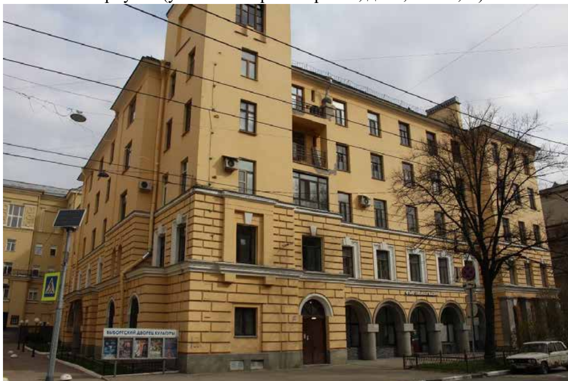
Фото 2. Вид южный фасад жилого корпуса (ул. Комиссара Смирнова, д. 15, лит. Б) выявленного объекта культурного наследия «Жилой дом Выборгского товарищества для устройства постоянных квартир (Дворец культуры «Выборгский» с двумя жилыми корпусами)».
