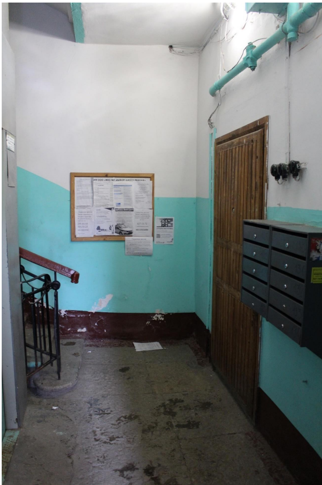
Фото 94. Западный жилой корпус (ул. Комиссара Смирнова, д. 15, лит. В) выявленного объекта культурного наследия «Жилой дом Выборгского товарищества для устройства постоянных квартир (Дворец культуры «Выборгский» с двумя жилыми корпусами)». Лестница 4ЛК, справа – вход в квартиру № 126.
