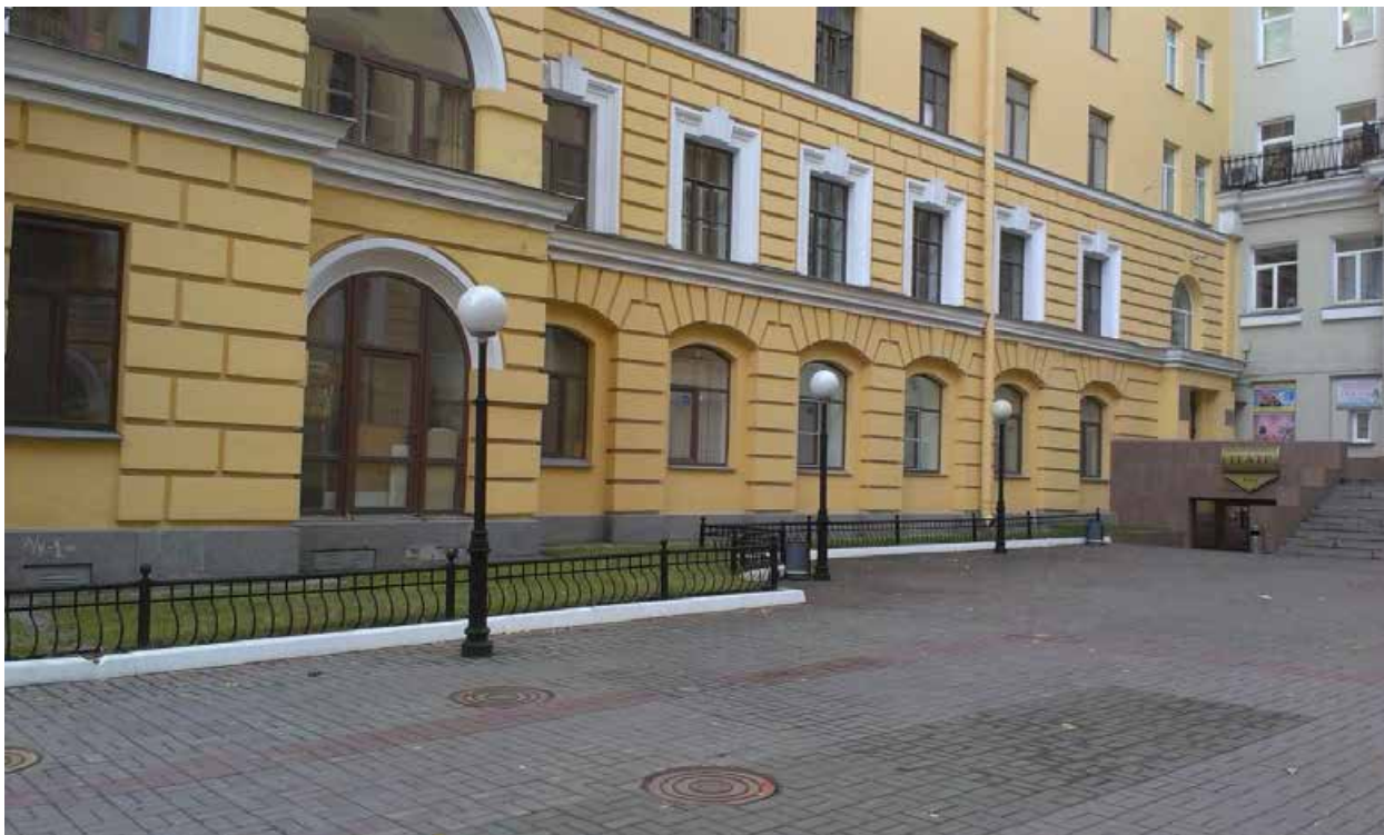
Илл. 42. Фрагмент восточного бокового фасада жилого корпуса здания (лит. Б). Заключение историко-культурной экспертизы от 2016 г. (Вх. № КГИОП от 07.04.2016 № 3-2418).
