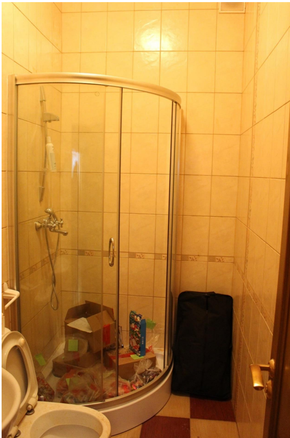
Фото 57. Восточный жилой корпус (ул. Комиссара Смирнова, д. 15, лит. Б) выявленного объекта культурного наследия «Жилой дом Выборгского товарищества для устройства постоянных квартир (Дворец культуры «Выборгский» с двумя жилыми корпусами)». Объединенные квартиры № 58, 59, помещение № 4.
