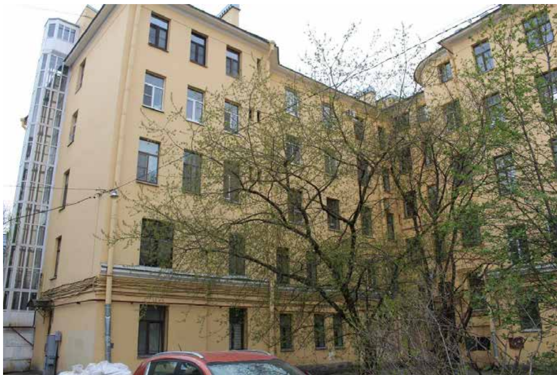
Фото 21. Вид на северный и восточный фасады жилого корпуса (ул. Комиссара Смирнова, д. 15, лит. Б) выявленного объекта культурного наследия «Жилой дом Выборгского товарищества для устройства постоянных квартир (Дворец культуры «Выборгский» с двумя жилыми корпусами)».
