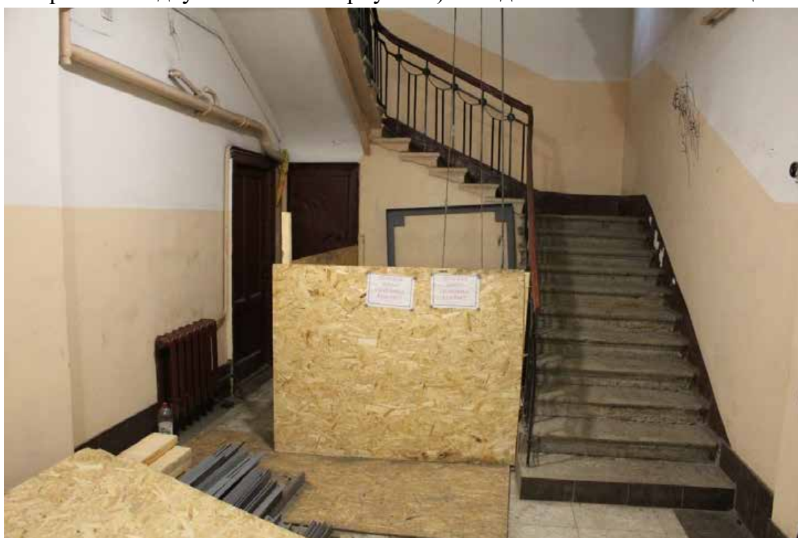
Фото 59. Западный жилой корпус (ул. Комиссара Смирнова, д. 15, лит. В) выявленного объекта культурного наследия «Жилой дом Выборгского товарищества для устройства постоянных квартир (Дворец культуры «Выборгский» с двумя жилыми корпусами)». Вид на лестницу 1ЛК.
