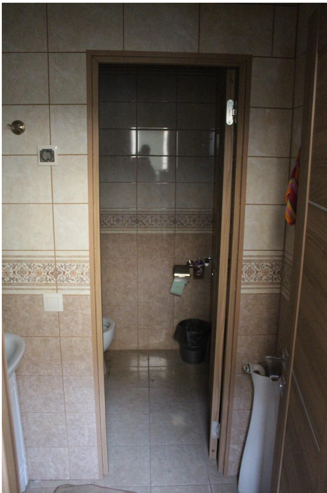
Фото 41. Восточный жилой корпус (ул. Комиссара Смирнова, д. 15, лит. Б) выявленного объекта культурного наследия «Жилой дом Выборгского товарищества для устройства постоянных квартир (Дворец культуры «Выборгский» с двумя жилыми корпусами)». Квартира № 40, новые перегородки в северной части помещения № 4 и помещение № 6.
