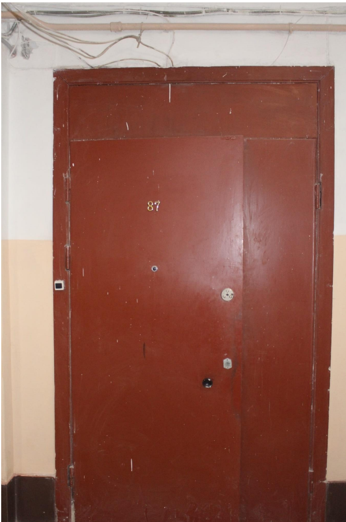
Фото 60. Западный жилой корпус (ул. Комиссара Смирнова, д. 15, лит. В) выявленного объекта культурного наследия «Жилой дом Выборгского товарищества для устройства постоянных квартир (Дворец культуры «Выборгский» с двумя жилыми корпусами)». Вход в квартиру № 87.
