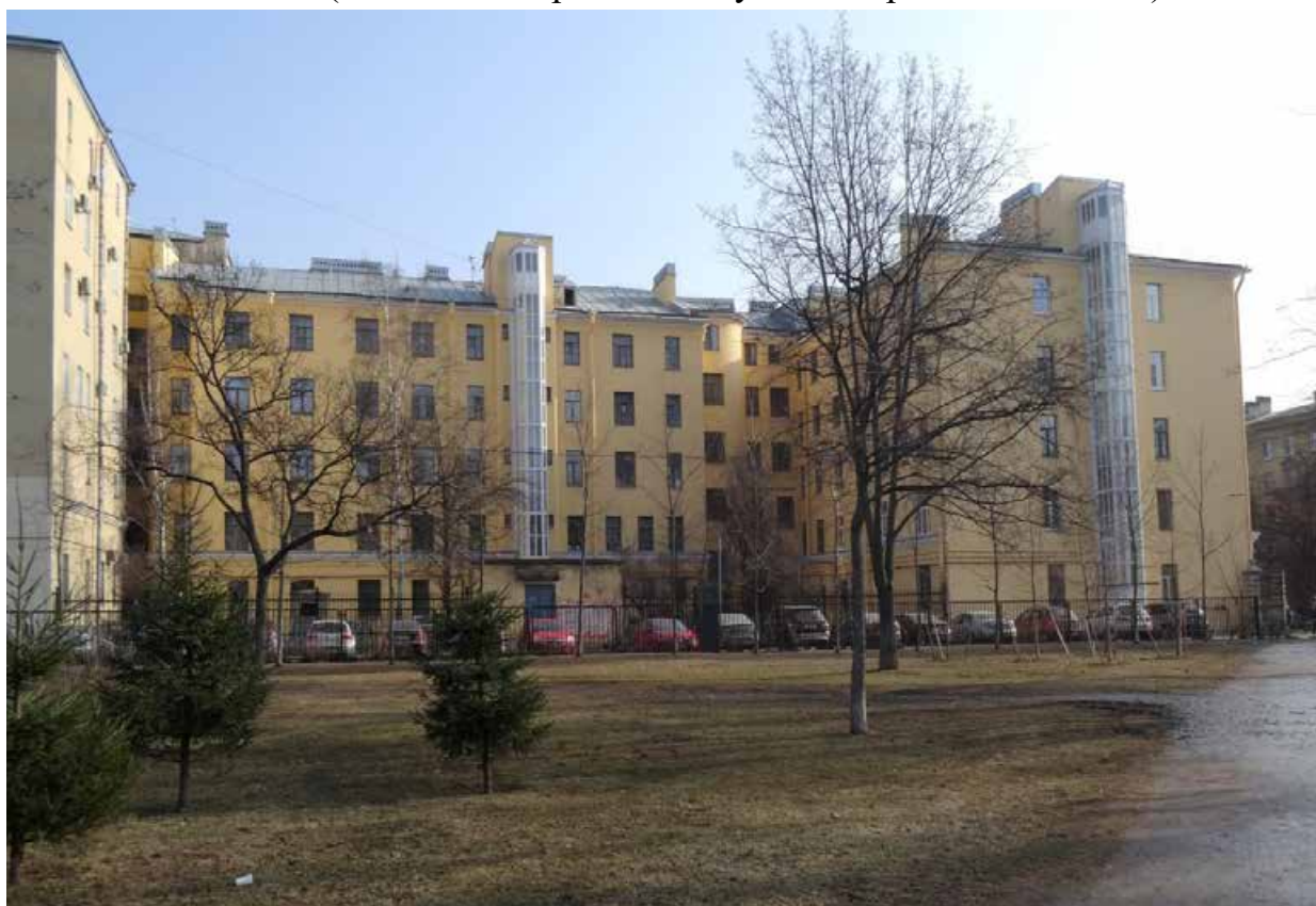
Илл. 36. Вид дворового фасада жилого дома (литер В) со стороны Выборгского сада. 2014 г. (источник: http://www.citywalls.ru/photo190322.html ).
