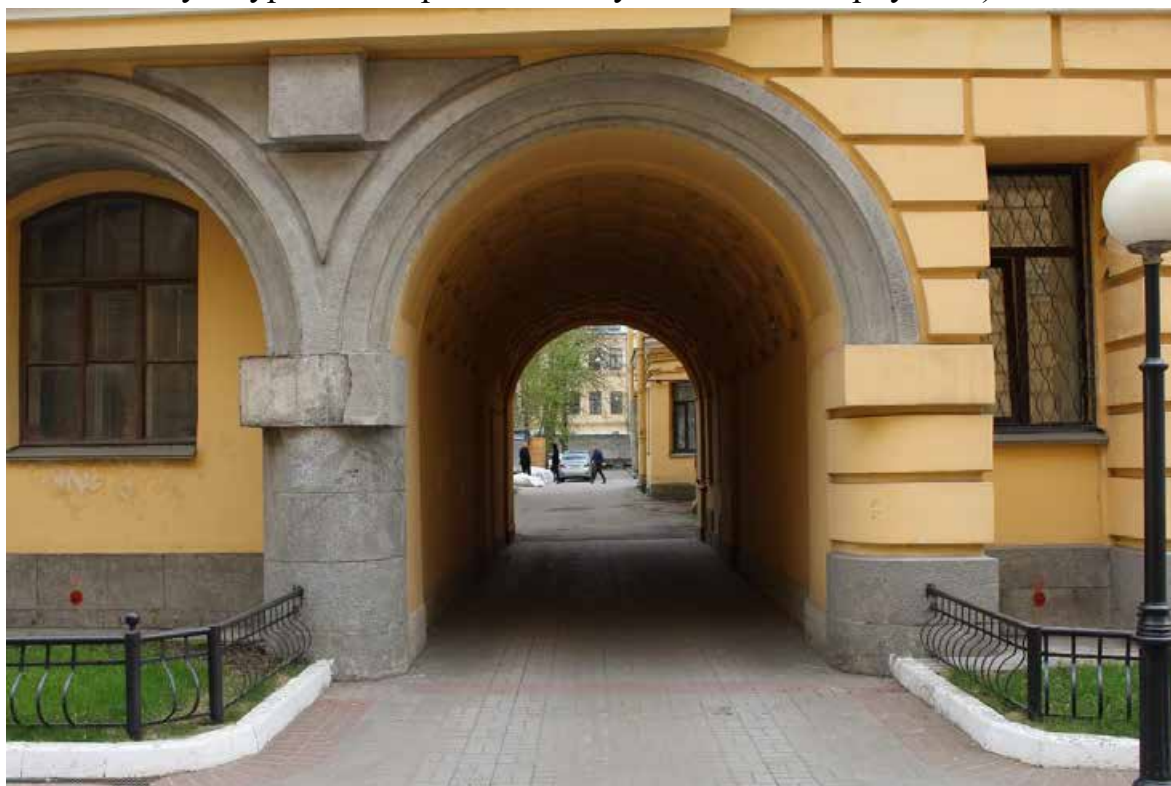
Фото 16. Арка воротного проезда в восточном жилом корпусе (ул. Комиссара Смирнова, д. 15, лит. Б) выявленного объекта культурного наследия «Жилой дом Выборгского товарищества для устройства постоянных квартир (Дворец культуры «Выборгский» с двумя жилыми корпусами)».
