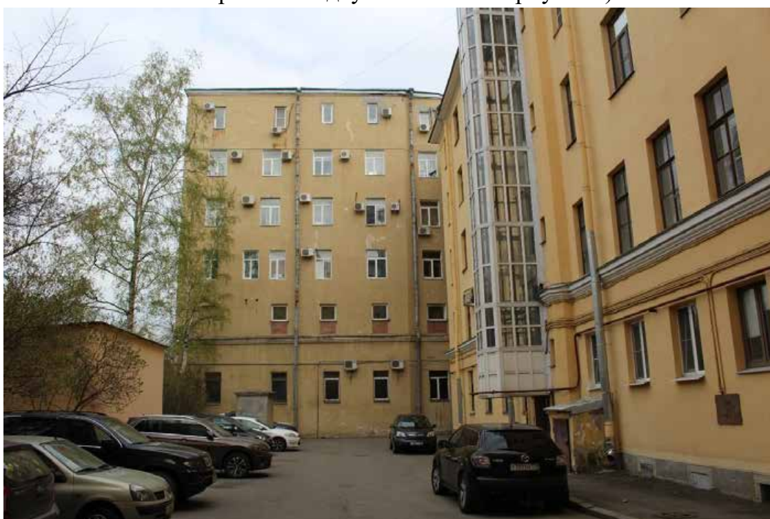
Фото 6. Вид на западную часть южного фасада Дворца культуры «Выборгский» и западный фасад жилого корпуса (ул. Комиссара Смирнова, д. 15, лит. В) выявленного объекта культурного наследия «Жилой дом Выборгского товарищества для устройства постоянных квартир (Дворец культуры «Выборгский» с двумя жилыми корпусами)».
