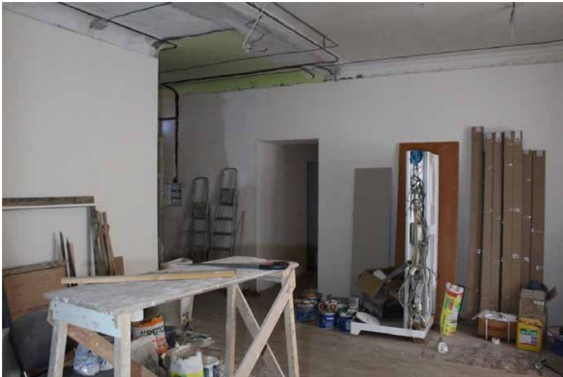
Фото 63. Западный жилой корпус (ул. Комиссара Смирнова, д. 15, лит. В) выявленного объекта культурного наследия «Жилой дом Выборгского товарищества для устройства постоянных квартир (Дворец культуры «Выборгский» с двумя жилыми корпусами)». Квартира № 87, объединенные помещения №№ 2, 3, 4.
