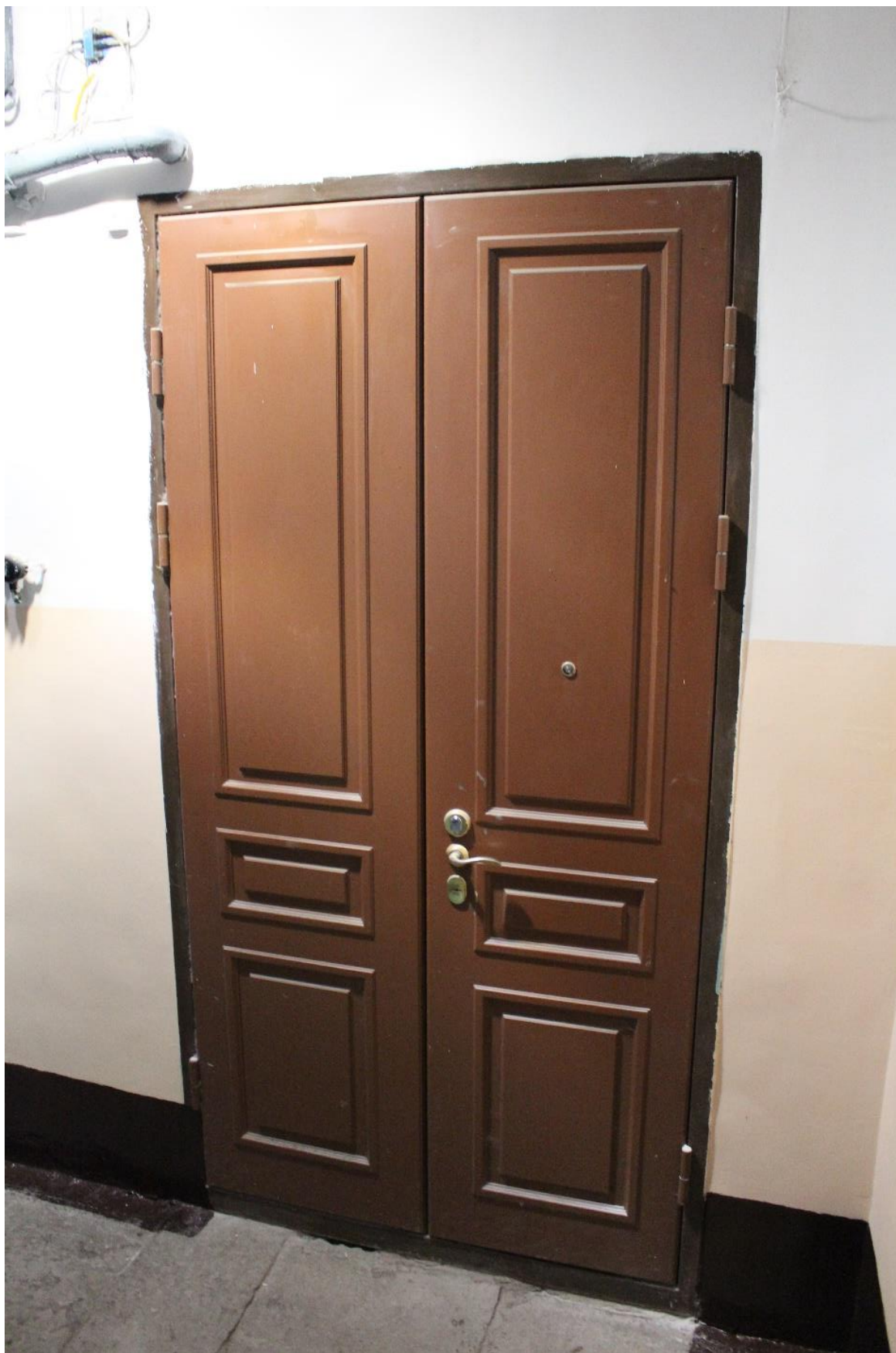
Фото 43. Восточный жилой корпус (ул. Комиссара Смирнова, д. 15, лит. Б) выявленного объекта культурного наследия «Жилой дом Выборгского товарищества для устройства постоянных квартир (Дворец культуры «Выборгский» с двумя жилыми корпусами)». Входная дверь квартиры № 59.
