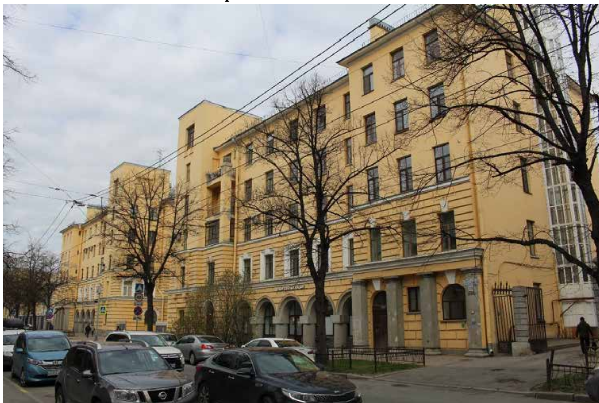
Фото 1. Выявленный объект культурного наследия «Жилой дом Выборгского товарищества для устройства постоянных квартир (Дворец культуры «Выборгский» с двумя жилыми корпусами)». Вид на южные фасады жилых корпусов (ул. Комиссара Смирнова, д. 15, лит. Б, В).
