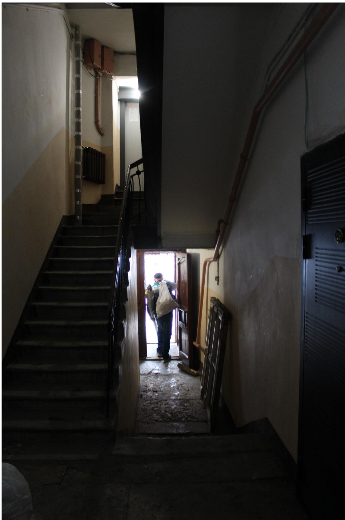
Фото 87. Западный жилой корпус (ул. Комиссара Смирнова, д. 15, лит. В) выявленного объекта культурного наследия «Жилой дом Выборгского товарищества для устройства постоянных квартир (Дворец культуры «Выборгский» с двумя жилыми корпусами)». Лестница 3ЛК.
