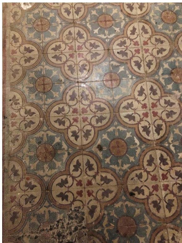
Фото 11. Покрытие пола вестибюля лестницы 2ЛК.
