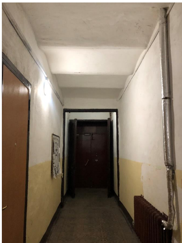
Фото 10. Вестибюль лестницы 2ЛК.
