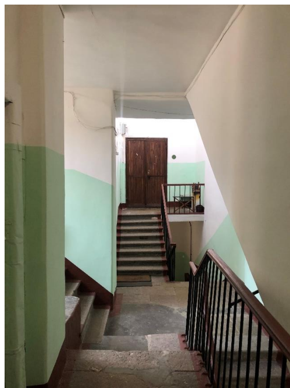
Фото 9. Лестница 1ЛК. Четвертый этаж.
