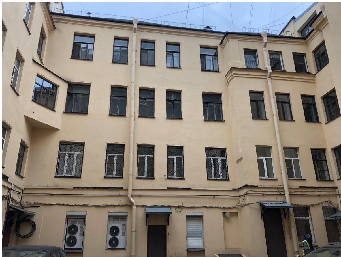
Фото 8. Вид на дворовой фасад.
