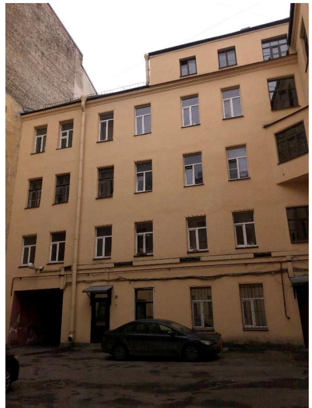
Фото 6. Вид на дворовой фасад.
