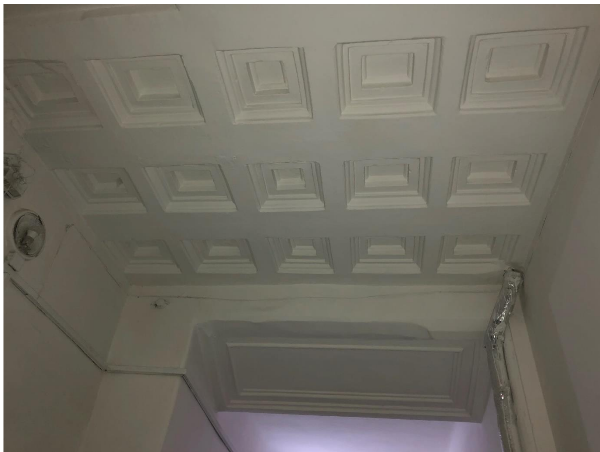
Фото 5. Вестибюль лестницы 1ЛК.
