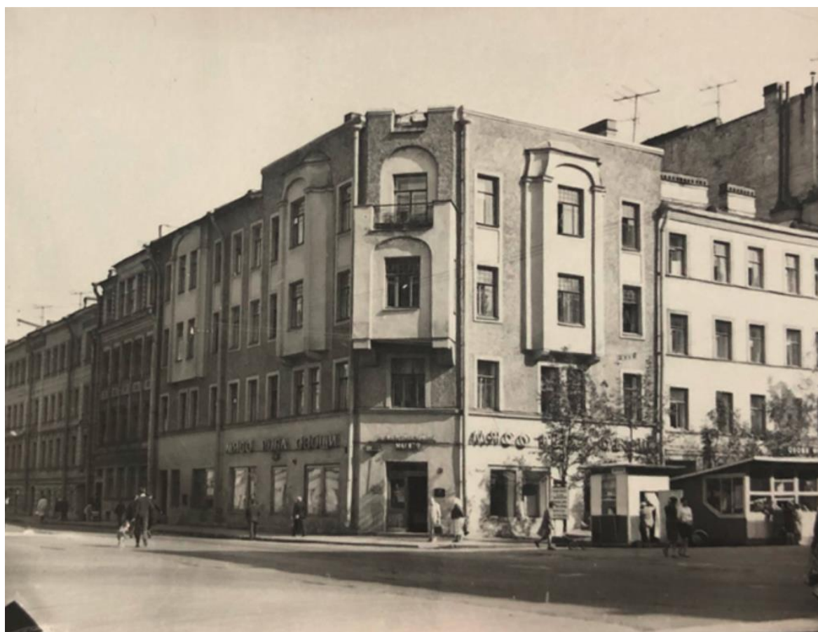
Илл. 47. Вид на дом № 51/16, 6-я линия. Дата: 1968 г. Источник: архив КГИОП, пл. XV-103, кат. В17-16.
