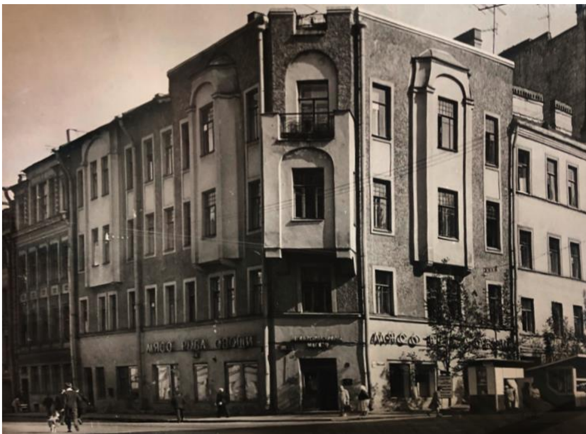
Илл. 48. Вид на дом № 51/16, 6-я линия. Дата: 1968 г. Источник: архив КГИОП, пл. XV-103, кат. В17-16.
