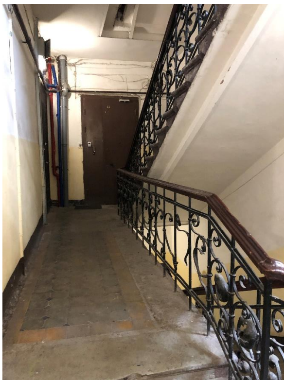
Фото 14. Лестница 2ЛК. 2-й этаж.
