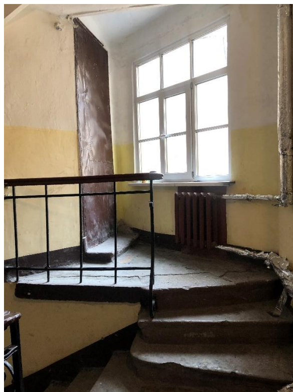
Фото 15. Лестница 2 ЛК. 3-й этаж.
