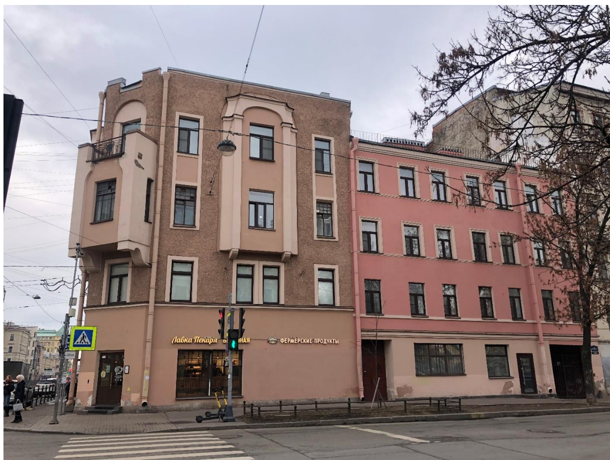
Фото 3. Вид на фасад здания № 51 по 6-й линии.
