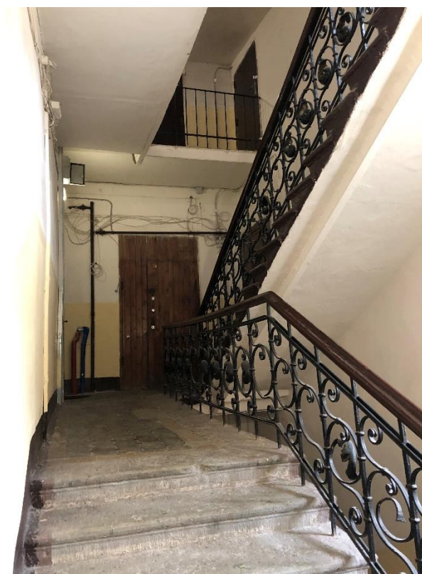
Фото 16. Лестница 2 ЛК. 4-й этаж.
