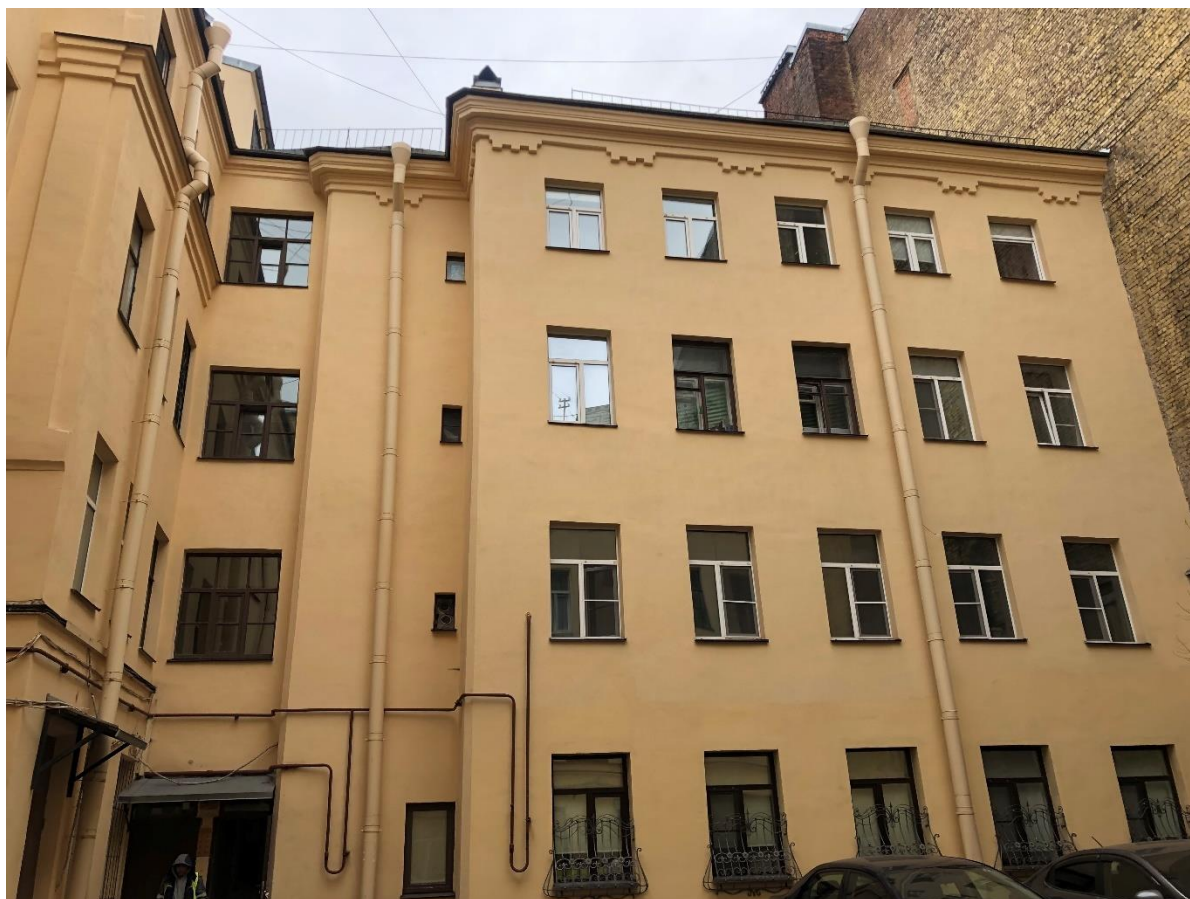
Фото 7. Вид на дворовой фасад.
