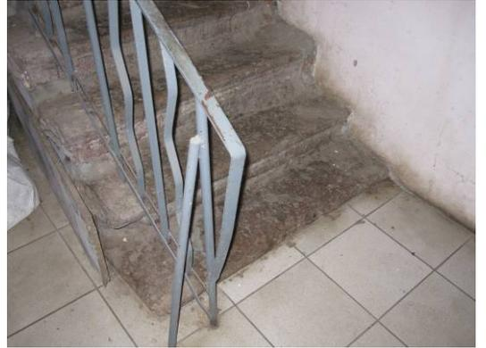
лестница (первый этаж, помещение № 17, площадью 15,6 м.кв.) – местоположение, габариты, конструкция (по косоурам), тип (двухмаршевая), материал ступеней (лещадная плита);
