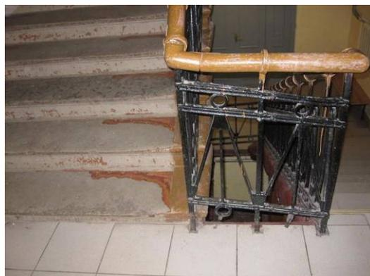
лестница ( первый этаж, помещение № 72, площадью 12,5 м.кв. – местоположение, габариты, конструкция (по металлическим косоурам), тип (трехмаршевая), материал ступеней (лещадная плита);
