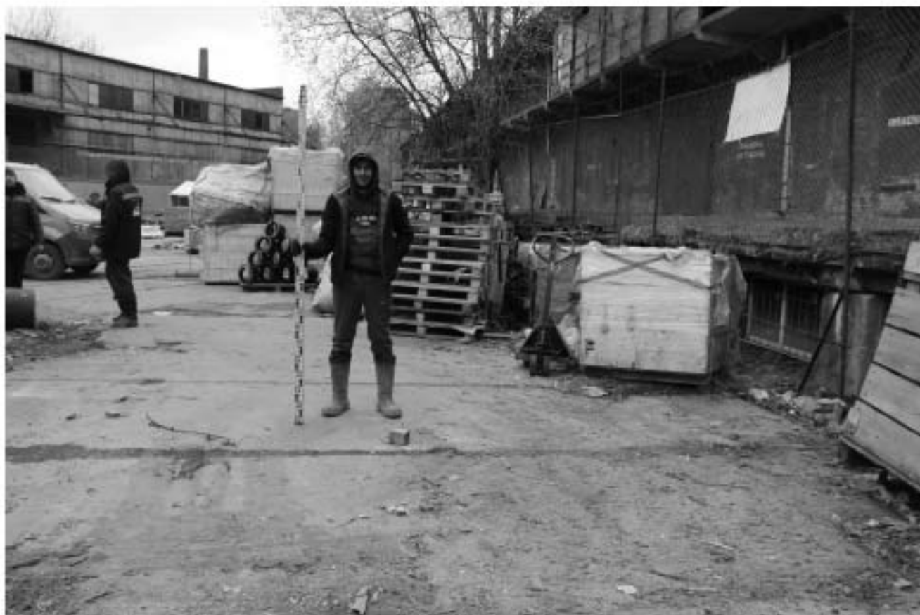
Рис. 34. Санкт-Петербург, Московский р-н, Малая Митрофаньевская д. 6. Шурф. Шурф. Общий вид до начала работ. Вид на В.
