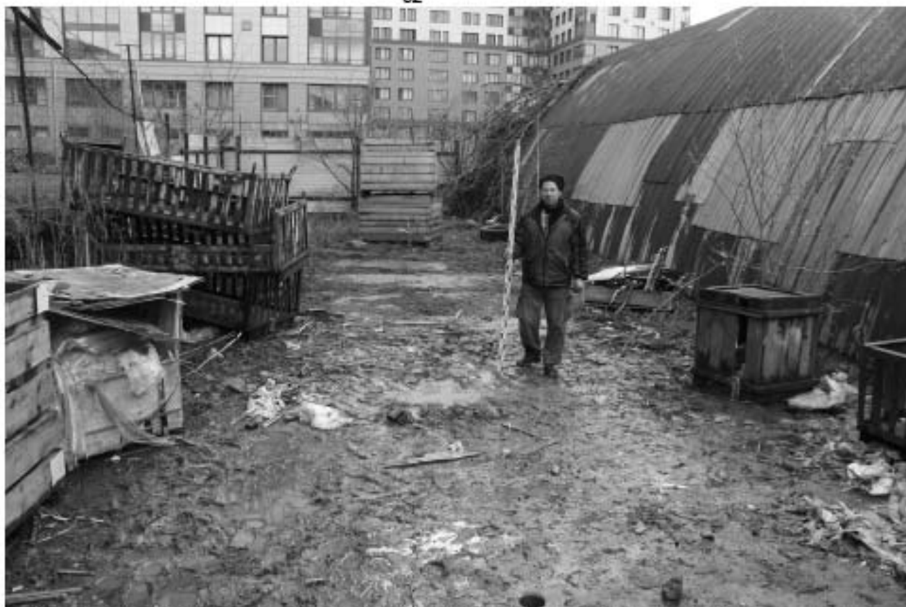
Рис. 13. Санкт-Петербург, Московский р-н, Малая Митрофаньевская д. 6. Точка съемки 1. Общий вид участка обследования. Вид на З.
