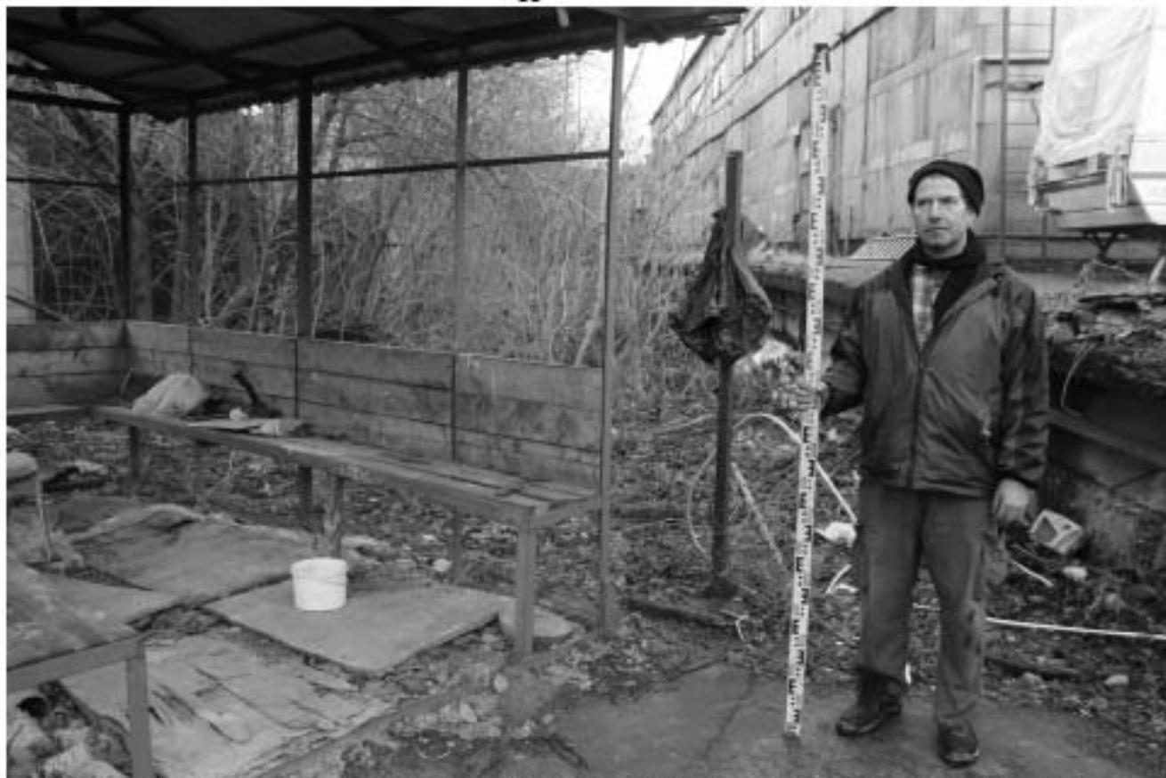
Рис. 27. Санкт-Петербург, Московский р-н, Малая Митрофаньевская д. 6. Точка съемки 5. Общий вид участка обследования. Вид на В.
