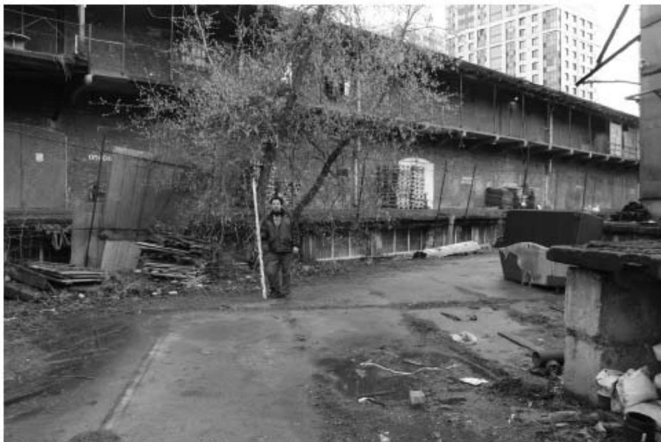
Рис. 32. Санкт-Петербург, Московский р-н, Малая Митрофаньевская д. 6. Точка съемки 8. Общий вид участка обследования. Вид на Ю.
