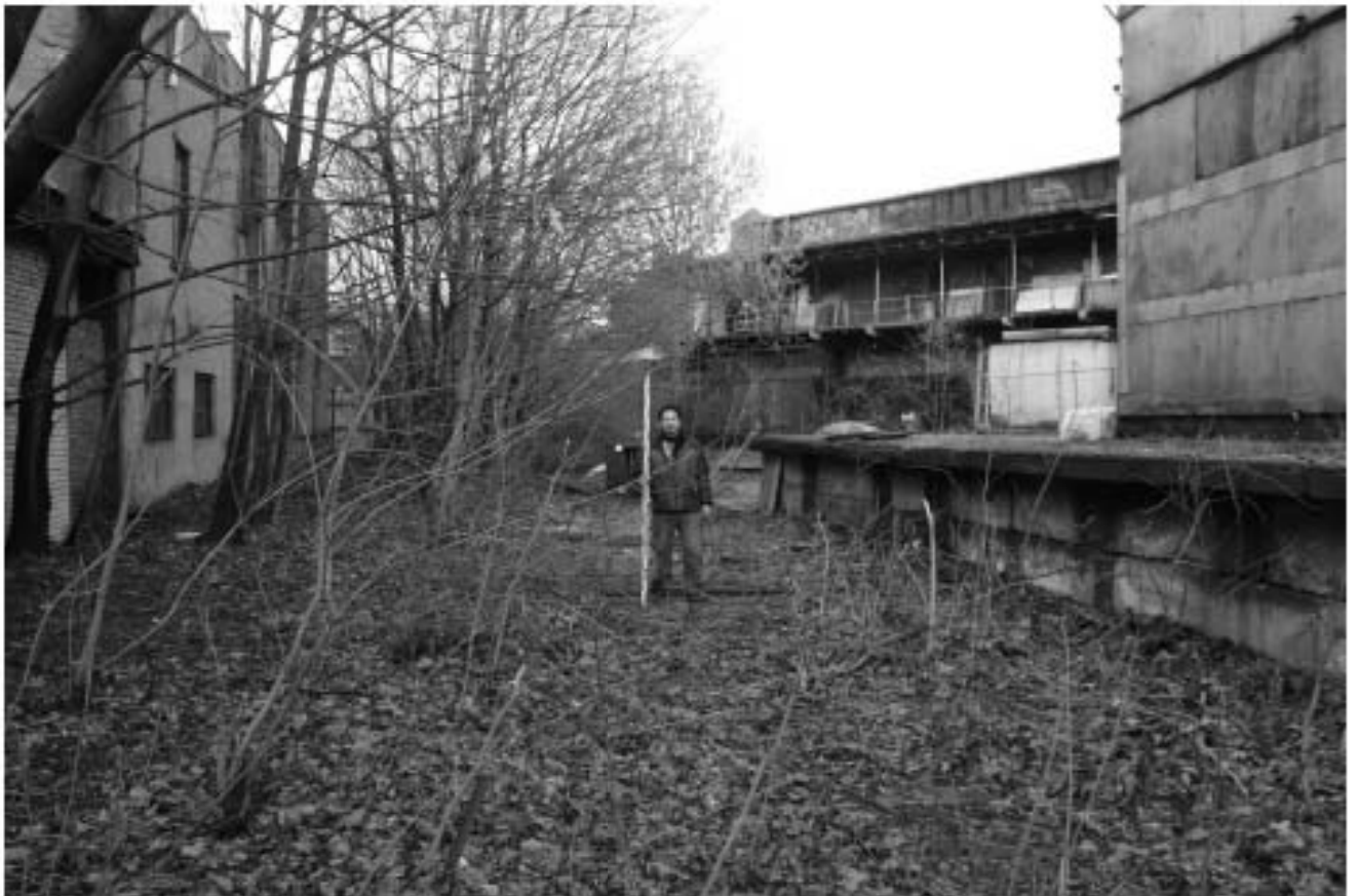
Рис. 30. Санкт-Петербург, Московский р-н, Малая Митрофаньевская д. 6. Точка съемки 7. Общий вид участка обследования. Вид на 3.
