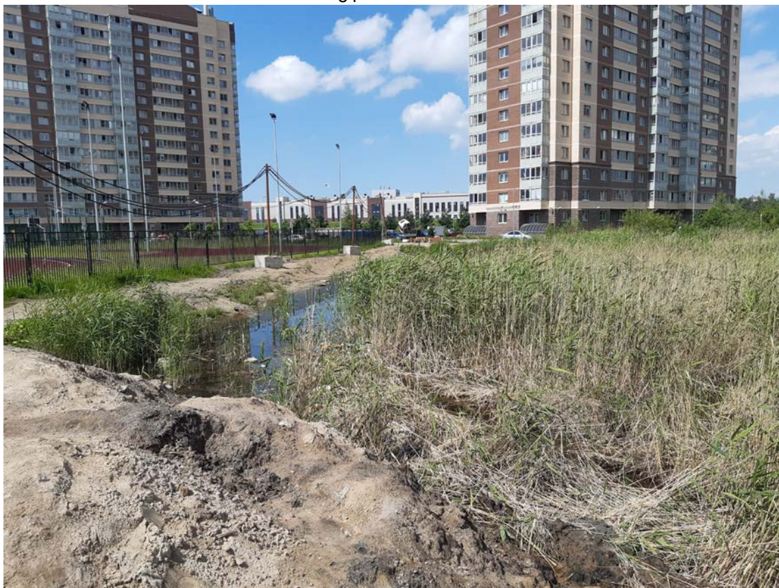
Рис. 31. Санкт-Петербург, Невский район, Дальневосточный пр. уч. 68. Общий вид участка. Точка съемки 6. Вид на северо-запад.
