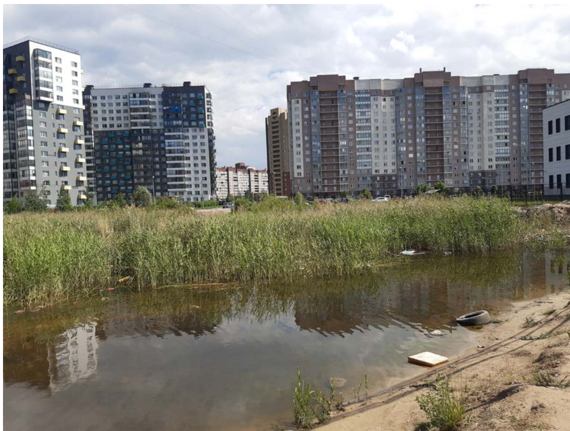
Рис. 32. Санкт-Петербург, Невский район, Дальневосточный пр. уч. 68. Общий вид участка. Точка съемки 7. Вид на запад.
