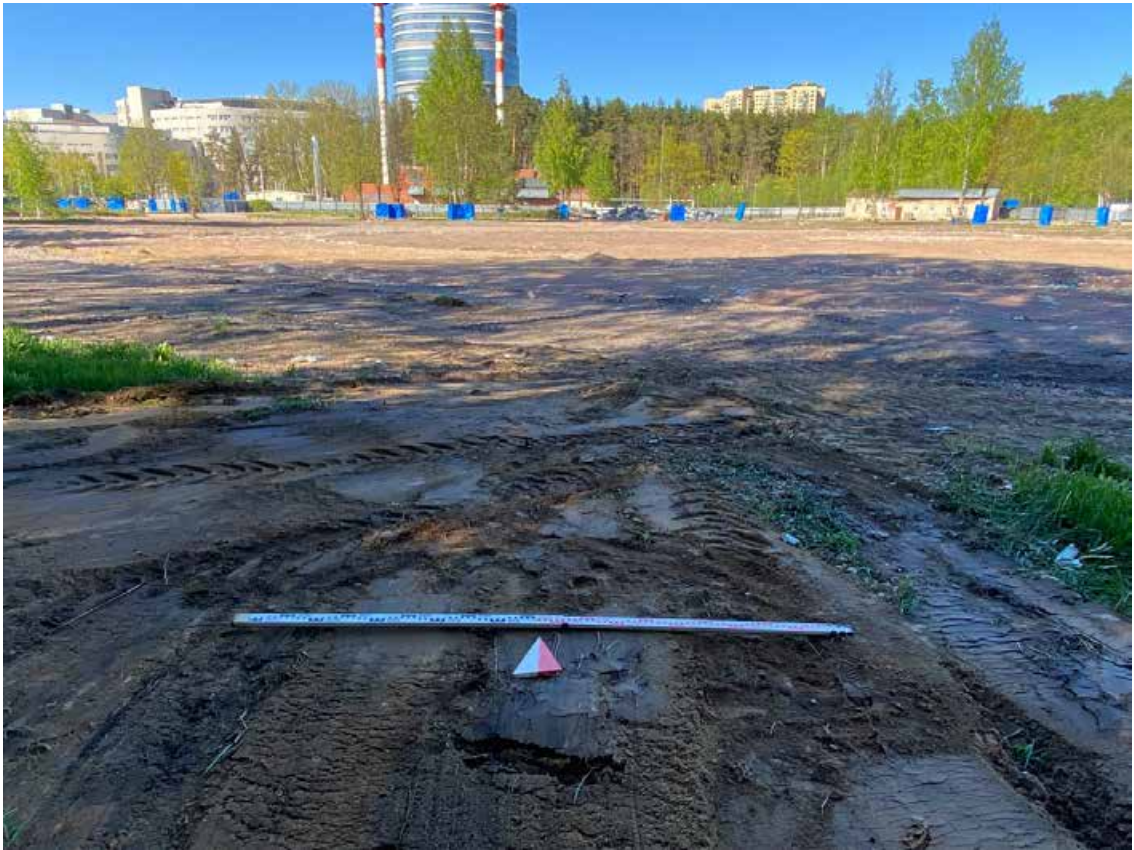
Рис. 50. СПБ-2024, улица Аккуратова, дом 7а, литера А. Шурф 1. Рекультивация. Общий вид. Вид с востока.
