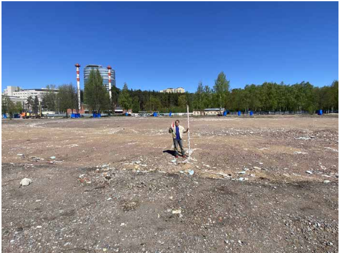
Рис. 29. СПБ-2024, улица Аккуратова, дом 7а, литера А. Photo 6. Общий вид территории обследования. Вид с юго-юго-запада.
