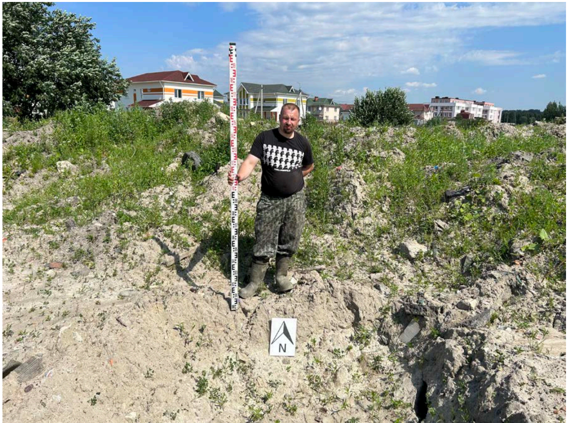
Рис. 20. Земельный участок с кадастровым номером 78:36:0013262:3829 по адресу Санкт-Петербург, внутригородское муниципальное образование Санкт-Петербурга поселок Парголово, Михайловская дорога, земельный участок 8. Место выполнения зачистки № 2, вид с юга.
