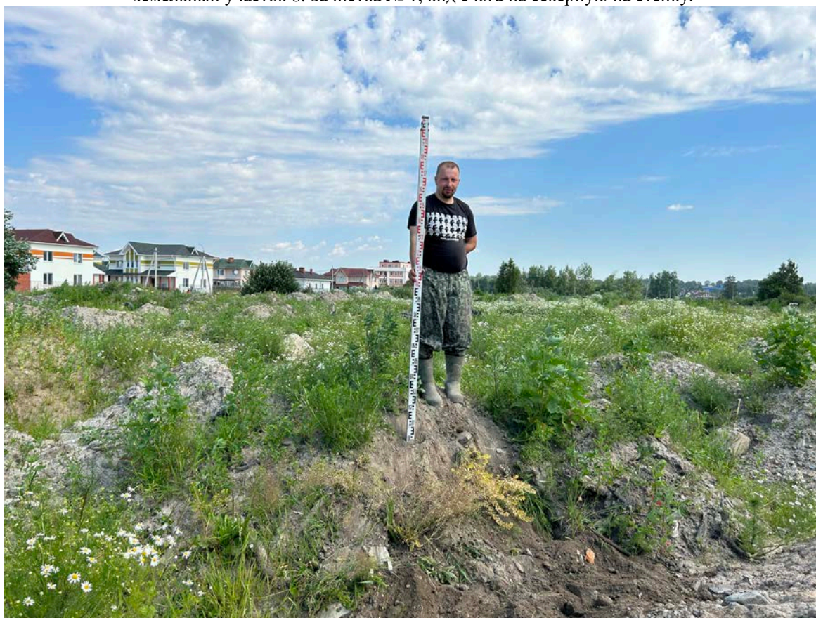
Рис. 199. Земельный участок с кадастровым номером 78:36:0013262:3829 по адресу Санкт-Петербург, внутригородское муниципальное образование Санкт-Петербурга поселок Парголово, Михайловская дорога, земельный участок 8. Место выполнения зачистки № 1, вид с юга после рекультивации.
