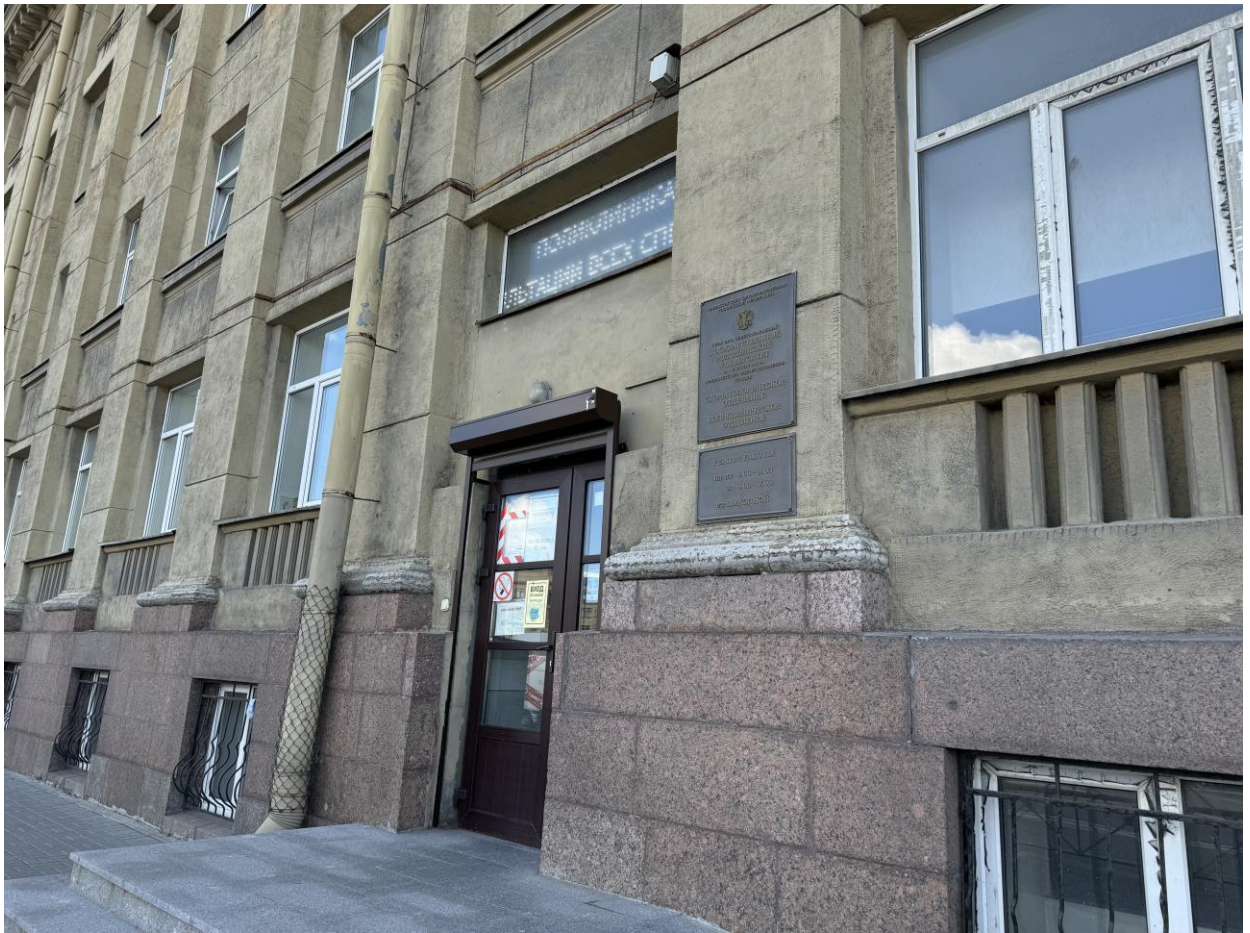
Фото 7. Объект культурного наследия регионального значения «Дом врача (Здание общежития Института усовершенствования врачей)», расположенный по адресу: г. Санкт-Петербург, Заневский проспект, дом 1/82, часть литеры А. Фото Васильева Н. В. (09.07.2024 г.)
