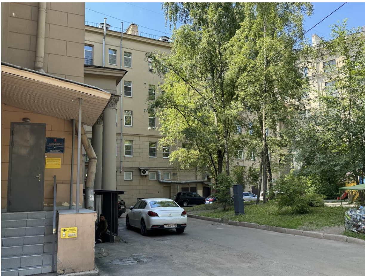
Фото 23. Объект культурного наследия регионального значения «Комплекс жилых домов (6 зданий)», расположенный по адресу: Санкт-Петербург, Малоохтинский проспект, дом 84, литера А, дом 86, литера А, дом 88, литера А, дом 92, литера А, дом 94, литера А, дом 96/2, литера А. Фото Васильева Н. В. (09.07.2024 г.)
