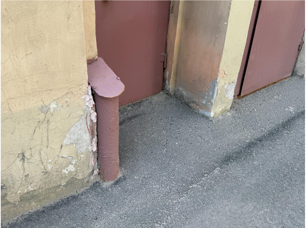
Фото 27. Объект культурного наследия регионального значения «Комплекс жилых домов (6 зданий)», расположенный по адресу: Санкт-Петербург, Малоохтинский проспект, дом 84, литера А, дом 86, литера А, дом 88, литера А, дом 92, литера А, дом 94, литера А, дом 96/2, литера А. Место ввода газовой трубы. Фото Васильева Н. В. (09.07.2024 г.)
