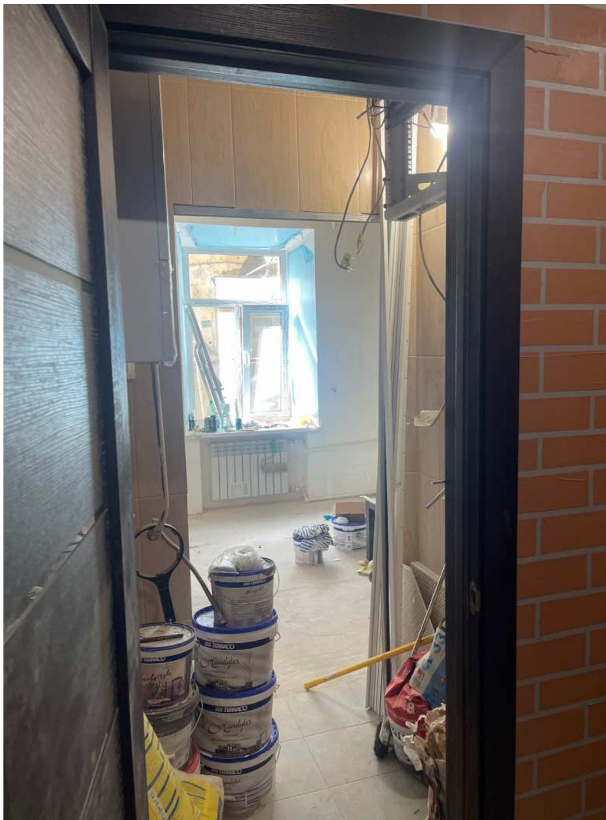
5. Фрагмент интерьера коридора и вид на кухню (помещение 5/12.7; 4/13.9);
