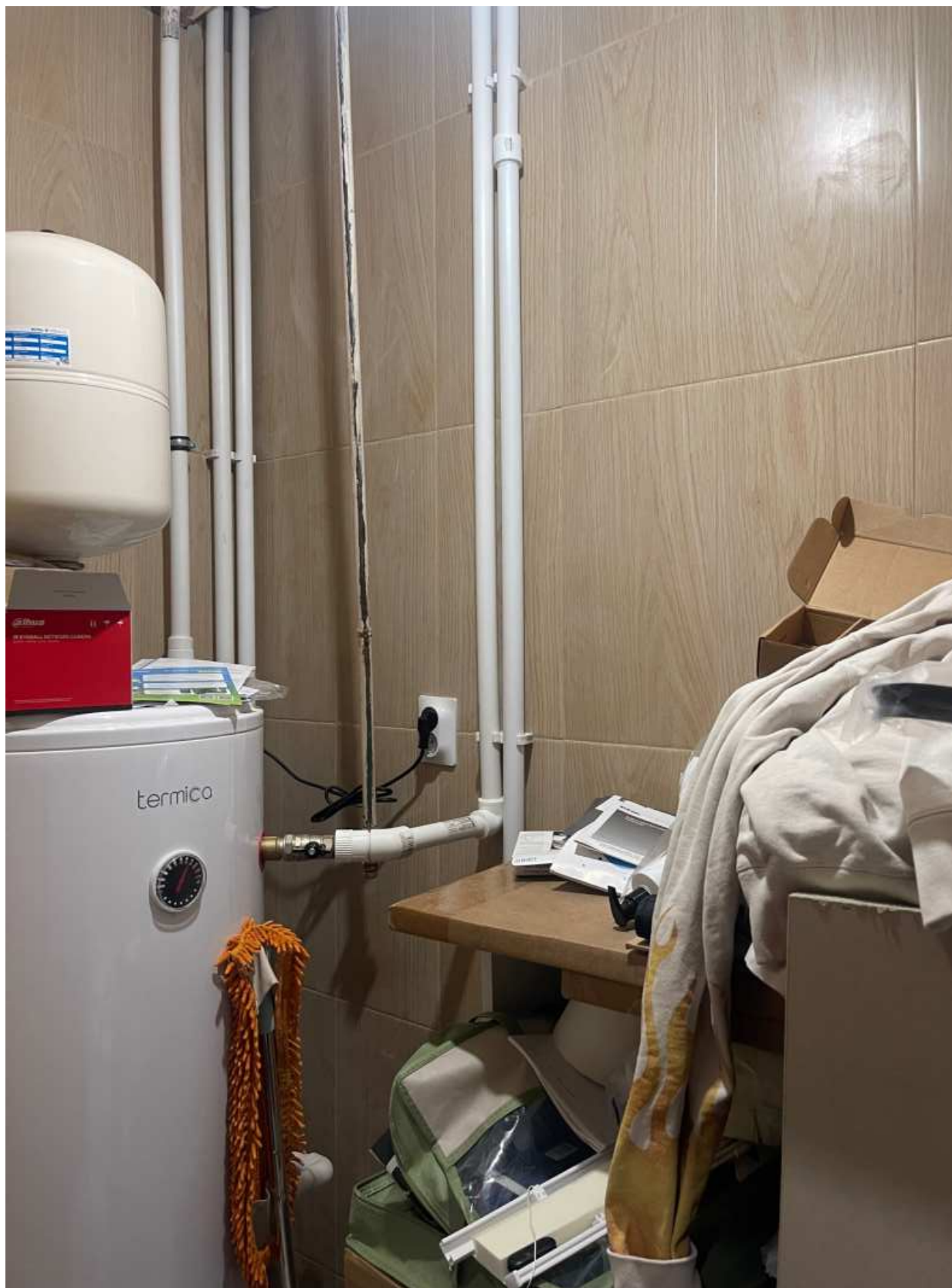
9. Фрагмент интерьера санузла (помещение 7/3);
