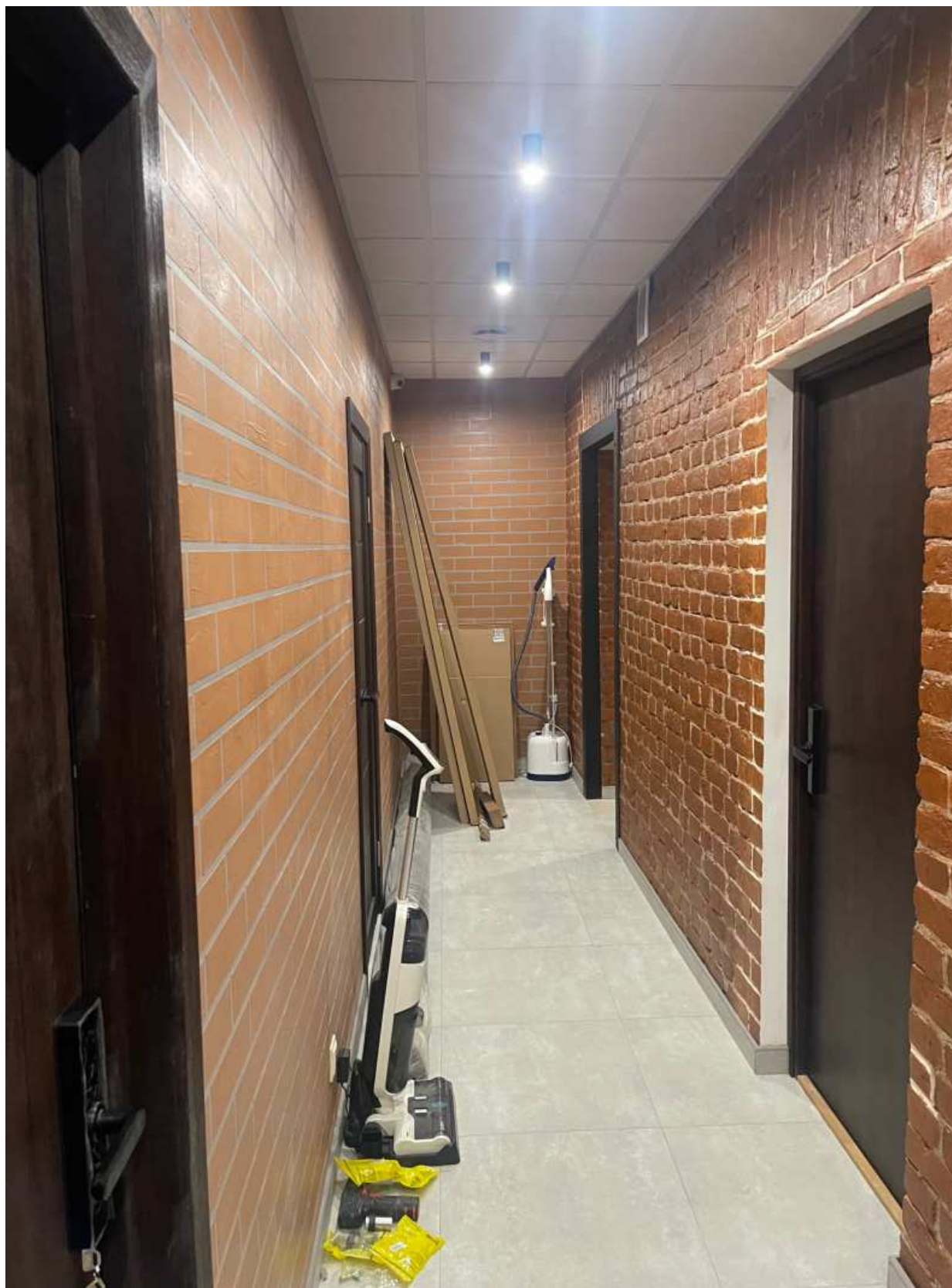
8. Фрагмент интерьера коридора (помещение 5/12.7);
