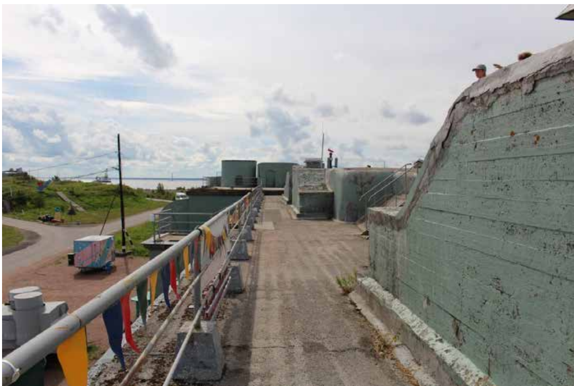
Фото 13. Вид на валганг центральной части (центральной оборонительной позиции форта) объекта культурного наследия федерального значения «Форт «Константин» – Батареи казематированной 2-х ярусной «Брылкин» на восемь 6-ти дюймовых (152 мм) орудий, 1898-1901 гг.
