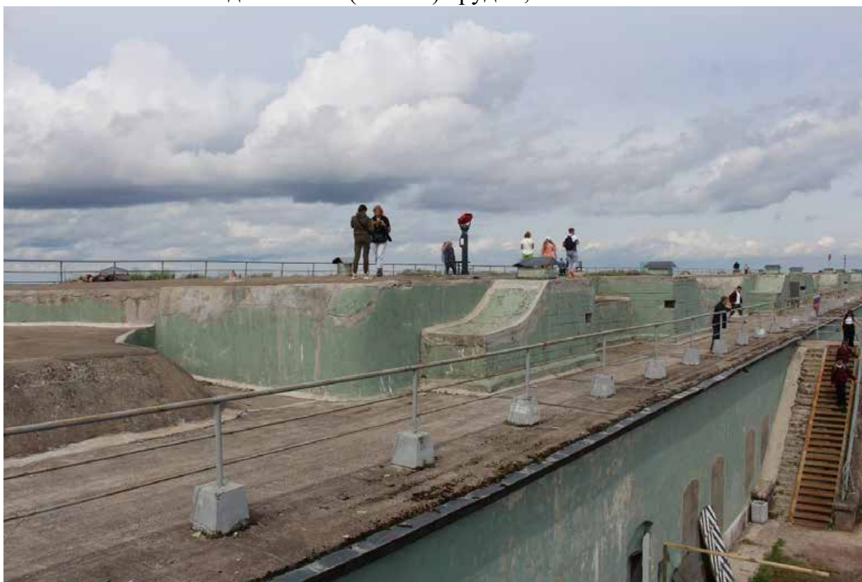
Фото 14. Вид на валганг центральной части (центральной оборонительной позиции форта) объекта культурного наследия федерального значения «Форт «Константин» – Батареи казематированной 2-х ярусной «Брылкин» на восемь 6-ти дюймовых (152 мм) орудий, 1898-1901 гг.
