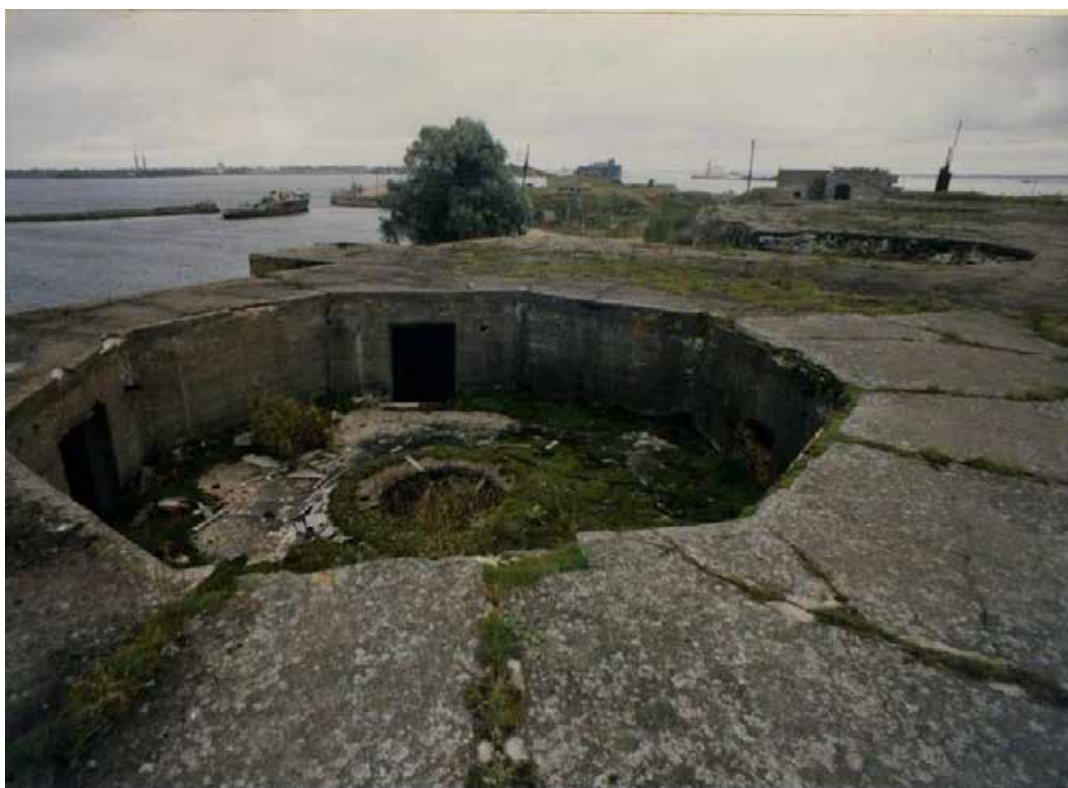
Илл. 26. Форт «Константин». Центральная часть. Батарея казематированная 2-х ярусная «Брылкин» 1898 - 1901 гг. Второй ярус. Закрытый бетонный дворик. Вид с севера. Натурная съемка: сентябрь 1998 г. Фото В. П. Орлова. Архив КГИОП. № 929. Паспорт.
