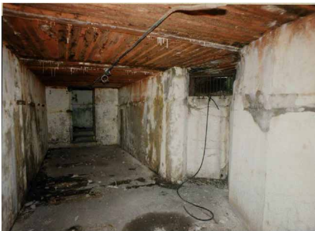
Илл. 28. Форт «Константин». Центральная часть. Батарея казематированная 2-х ярусная «Брылкин» 1898 - 1901 гг. Второй ярус. Снарядный погреб. Вид с запада. Натурная съемка: сентябрь 1998 г. Фото В. П. Орлова. Архив КГИОП. № 929. Паспорт.
