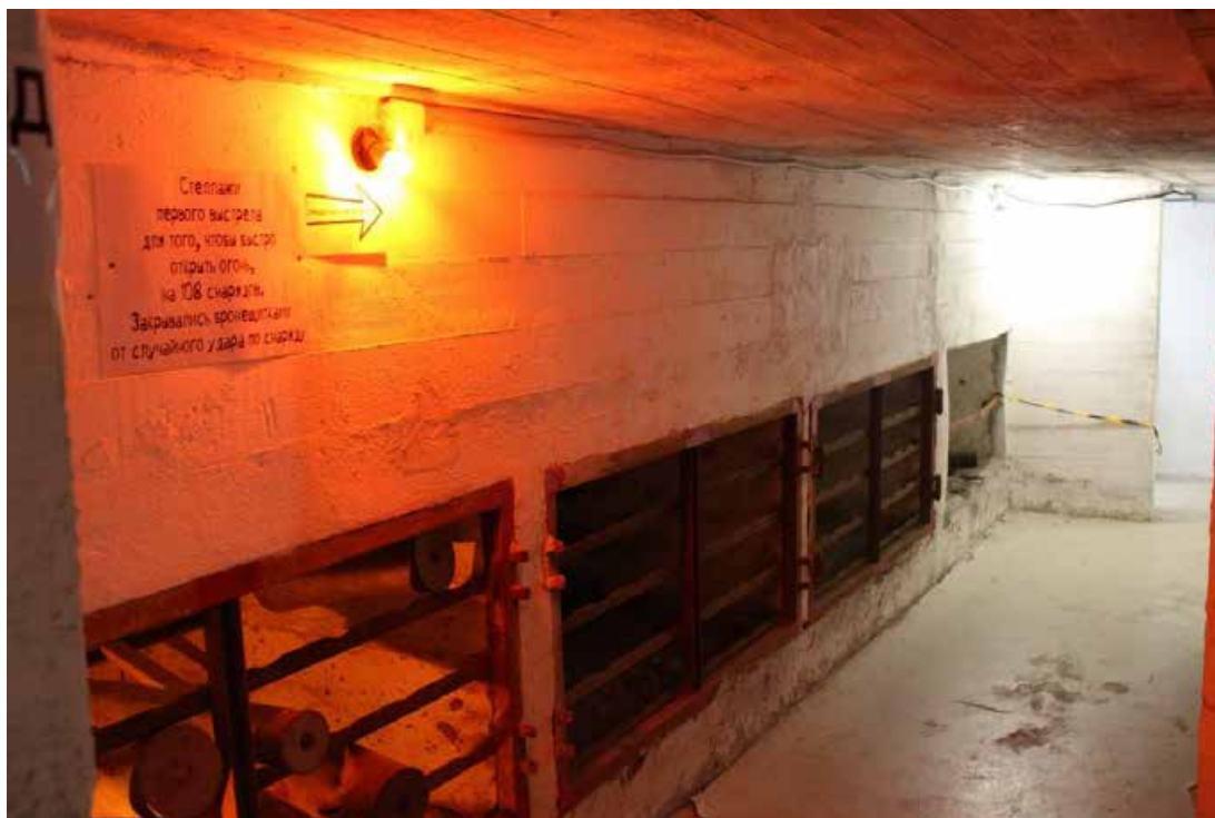
Фото 52. Внутренние помещения 2-го яруса центральной части (центральной оборонительной позиции форта) объекта культурного наследия федерального значения «Форт «Константин» – Батареи казематированной 2-х ярусной «Брылкин» на восемь 6-ти дюймовых (152 мм) орудий, 1898-1901 гг.
