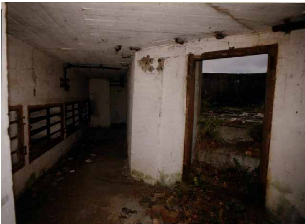
Илл. 29. Форт «Константин». Центральная часть. Батарея казематированная 2-х ярусная «Брылкин» 1898 - 1901 гг. Второй ярус. Галерея закрытого бетонного двора. Вид с северо-востока. Натурная съемка: сентябрь 1998 г. Фото В. П. Орлова. Архив КГИОП. № 929. Паспорт.
