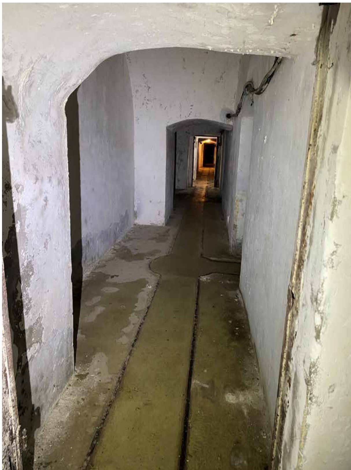
Фото 35. Внутренние помещения 1-го яруса центральной части (центральной оборонительной позиции форта) объекта культурного наследия федерального значения «Форт «Константин» – Батареи казематированной 2-х ярусной «Брылкин» на восемь 6-ти дюймовых (152 мм) орудий, 1898-1901 гг.
