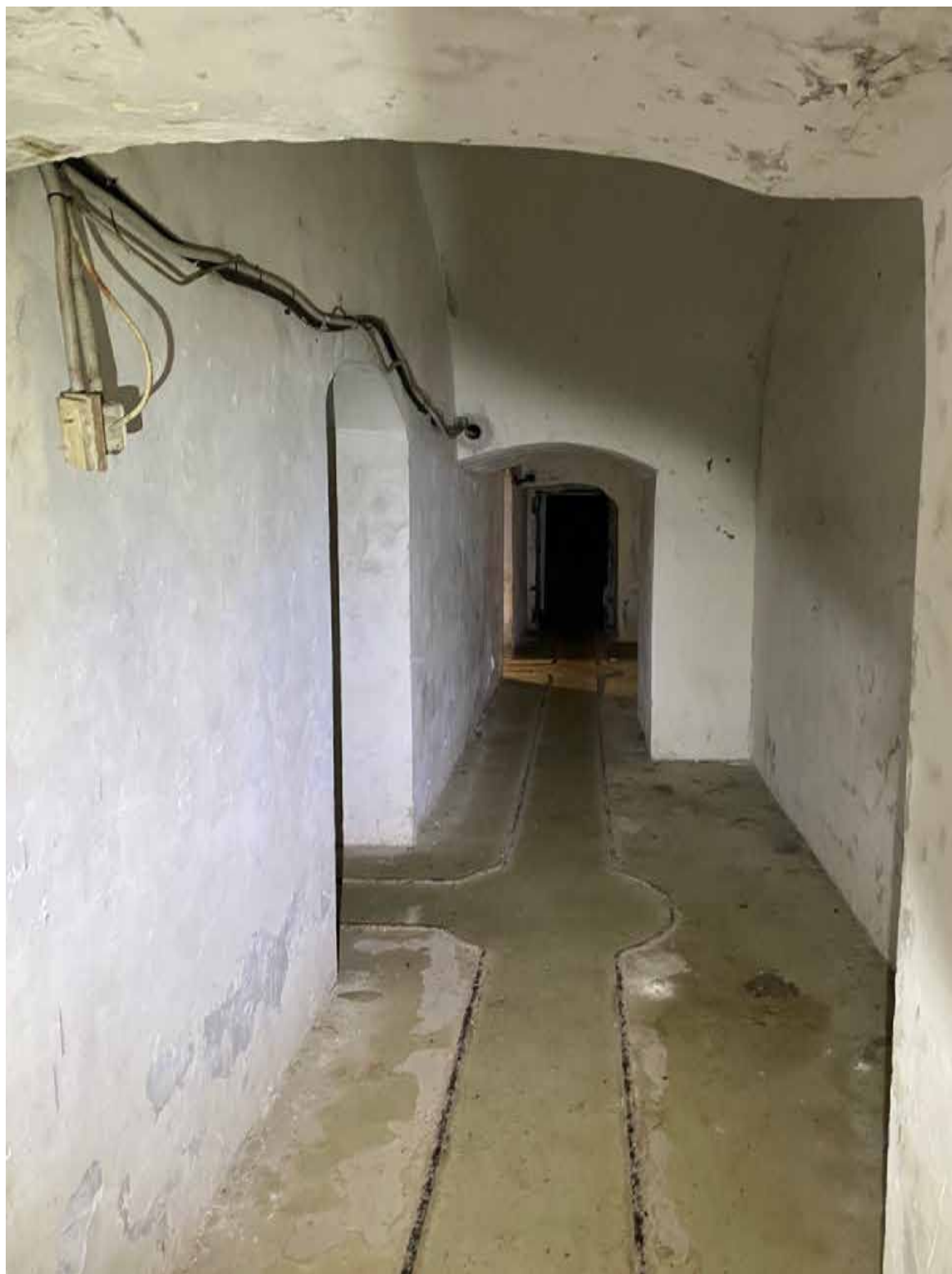
Фото 33. Внутренние помещения 1-го яруса центральной части (центральной оборонительной позиции форта) объекта культурного наследия федерального значения «Форт «Константин» – Батареи казематированной 2-х ярусной «Брылкин» на восемь 6-ти дюймовых (152 мм) орудий, 1898-1901 гг.
