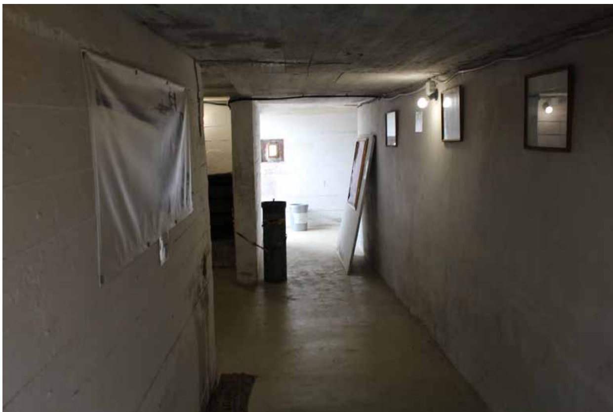
Фото 54. Внутренние помещения 2-го яруса центральной части (центральной оборонительной позиции форта) объекта культурного наследия федерального значения «Форт «Константин» – Батареи казематированной 2-х ярусной «Брылкин» на восемь 6-ти дюймовых (152 мм) орудий, 1898-1901 гг.
