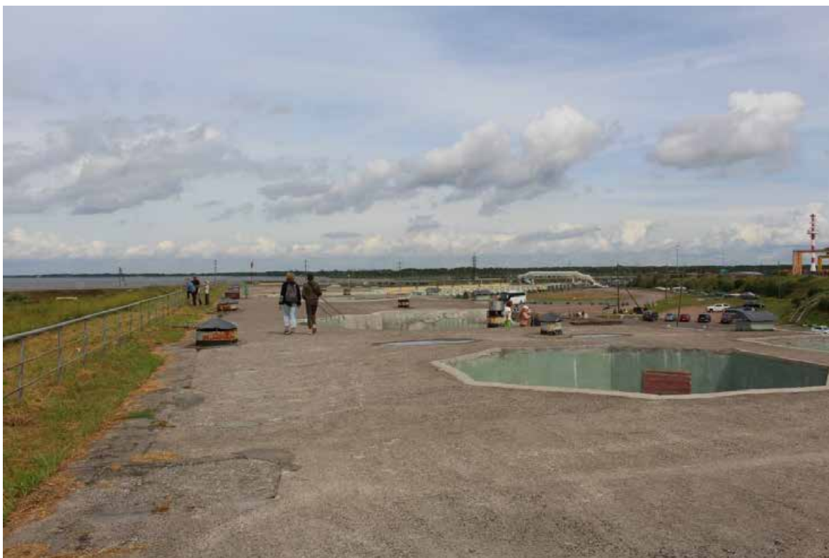
Фото 17. Вид на валганг центральной части (центральной оборонительной позиции форта) объекта культурного наследия федерального значения «Форт «Константин» – Батареи казематированной 2-х ярусной «Брылкин» на восемь 6-ти дюймовых (152 мм) орудий, 1898-1901 гг.
