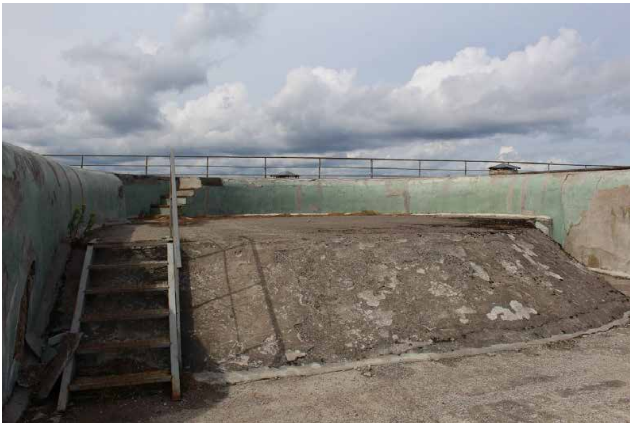
Фото 11. Вид на валганг центральной части (центральной оборонительной позиции форта) объекта культурного наследия федерального значения «Форт «Константин» – Батареи казематированной 2-х ярусной «Брылкин» на восемь 6-ти дюймовых (152 мм) орудий, 1898-1901 гг.
