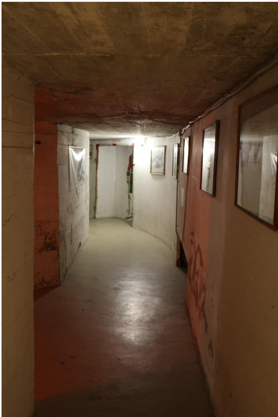
Фото 51. Внутренние помещения 2-го яруса центральной части (центральной оборонительной позиции форта) объекта культурного наследия федерального значения «Форт «Константин» – Батареи казематированной 2-х ярусной «Брылкин» на восемь 6-ти дюймовых (152 мм) орудий, 1898-1901 гг.
