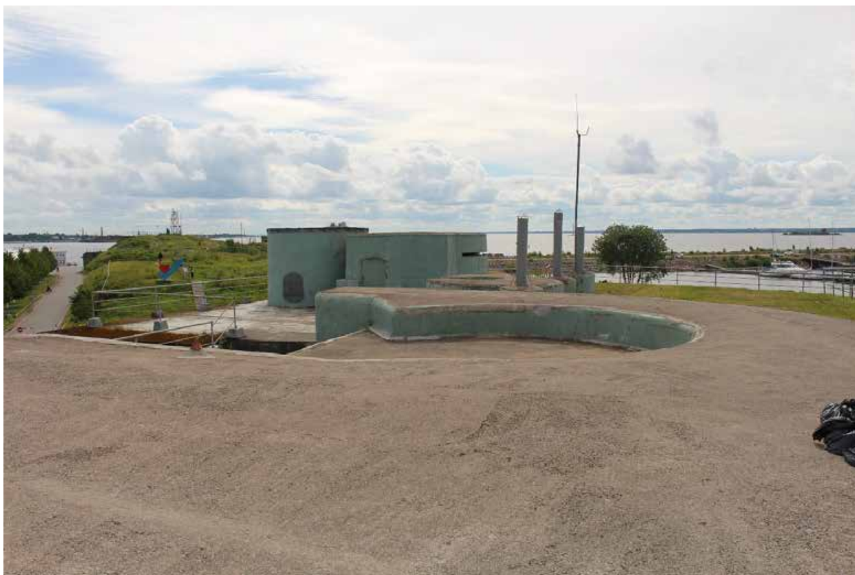
Фото 19. Вид на валганг центральной части (центральной оборонительной позиции форта) объекта культурного наследия федерального значения «Форт «Константин» – Батареи казематированной 2-х ярусной «Брылкин» на восемь 6-ти дюймовых (152 мм) орудий, 1898-1901 гг.
