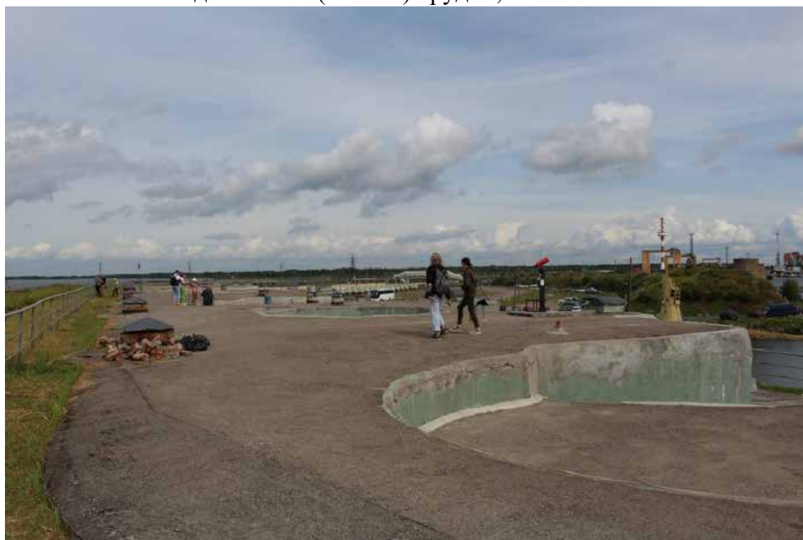
Фото 16. Вид на валганг центральной части (центральной оборонительной позиции форта) объекта культурного наследия федерального значения «Форт «Константин» – Батареи казематированной 2-х ярусной «Брылкин» на восемь 6-ти дюймовых (152 мм) орудий, 1898-1901 гг.
