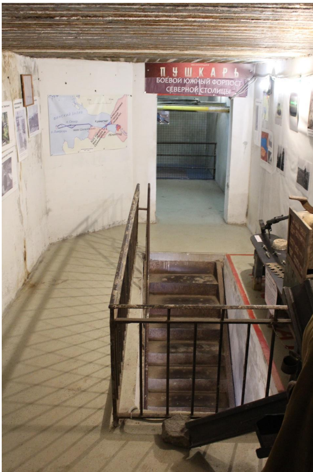
Фото 50. Внутренние помещения 2-го яруса центральной части (центральной оборонительной позиции форта) объекта культурного наследия федерального значения «Форт «Константин» – Батареи казематированной 2-х ярусной «Брылкин» на восемь 6-ти дюймовых (152 мм) орудий, 1898-1901 гг.
