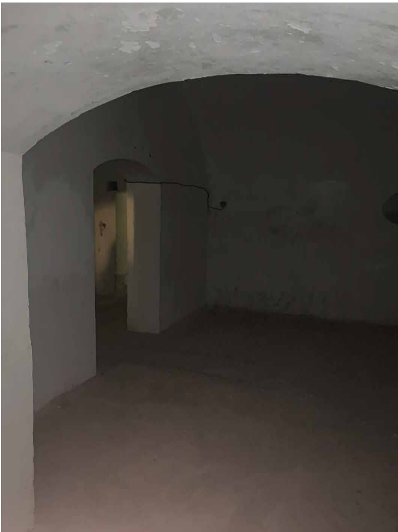
Фото 36. Внутренние помещения 1-го яруса центральной части (центральной оборонительной позиции форта) объекта культурного наследия федерального значения «Форт «Константин» – Батареи казематированной 2-х ярусной «Брылкин» на восемь 6-ти дюймовых (152 мм) орудий, 1898-1901 гг.
