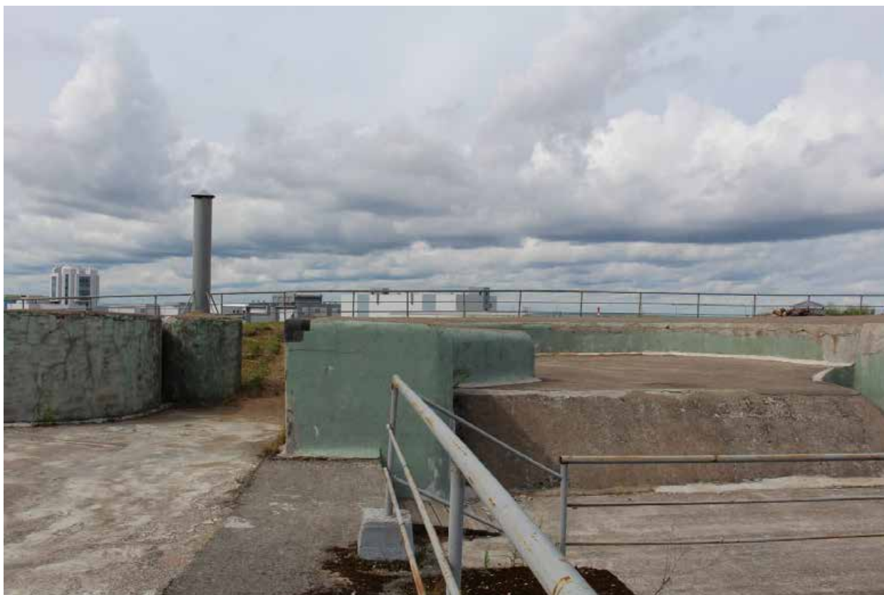
Фото 15. Вид на валганг центральной части (центральной оборонительной позиции форта) объекта культурного наследия федерального значения «Форт «Константин» – Батареи казематированной 2-х ярусной «Брылкин» на восемь 6-ти дюймовых (152 мм) орудий, 1898-1901 гг.
