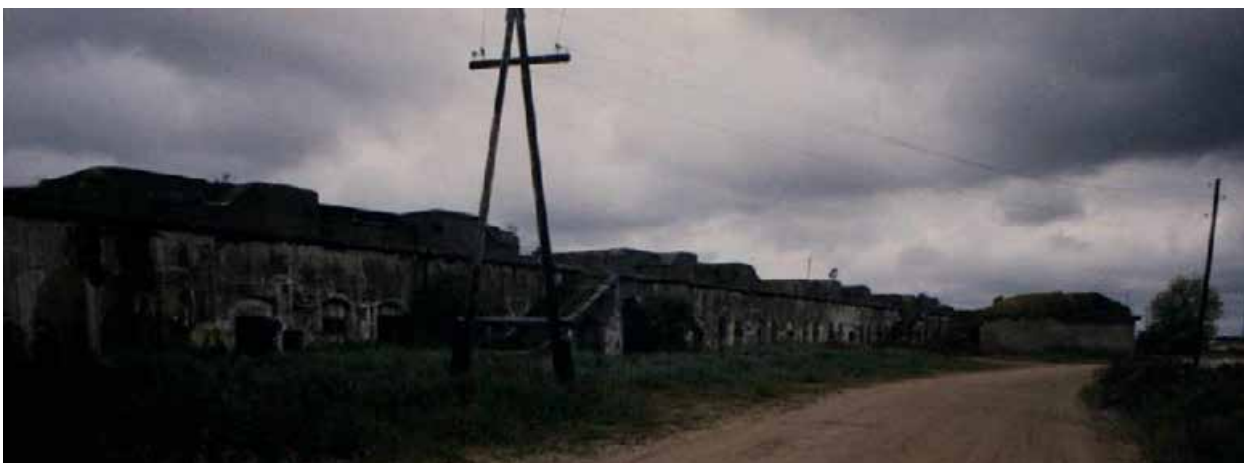
Илл. 24. Форт «Константин». Центральная часть. Батарея казематированная 2-х ярусная «Брылкин» 1898 - 1901 гг. Вид с востока. Натурная съемка: сентябрь 1998 г. Фото В. П. Орлова. Архив КГИОП. № 929. Паспорт.
