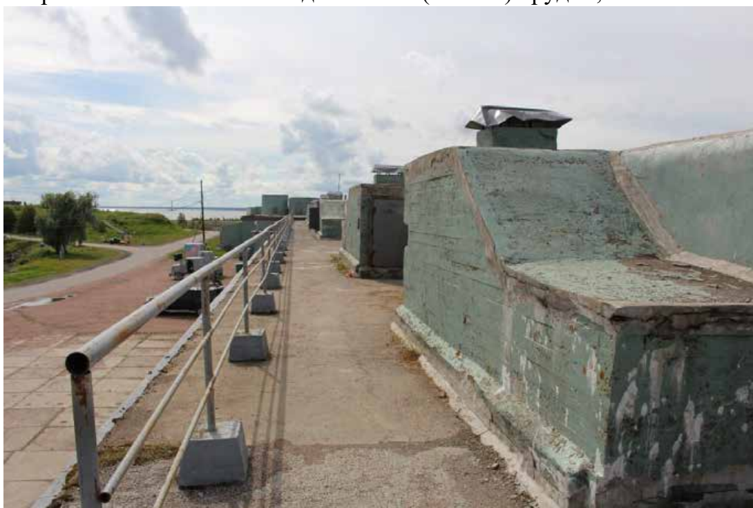
Фото 10. Вид на валганг центральной части (центральной оборонительной позиции форта) объекта культурного наследия федерального значения «Форт «Константин» – Батареи казематированной 2-х ярусной «Брылкин» на восемь 6-ти дюймовых (152 мм) орудий, 1898-1901 гг.
