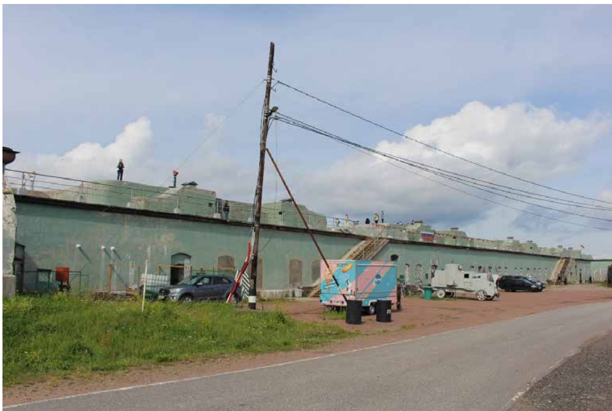
Фото 9. Вид на горжевой фасад центральной части (центральной оборонительной позиции форта) объекта культурного наследия федерального значения «Форт «Константин» – Батареи казематированной 2-х ярусной «Брылкин» на восемь 6-ти дюймовых (152 мм) орудий, 1898-1901 гг.
