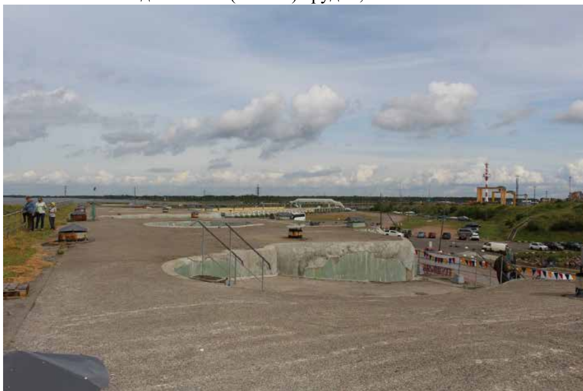
Фото 20. Вид на валганг центральной части (центральной оборонительной позиции форта) объекта культурного наследия федерального значения «Форт «Константин» – Батареи казематированной 2-х ярусной «Брылкин» на восемь 6-ти дюймовых (152 мм) орудий, 1898-1901 гг.
