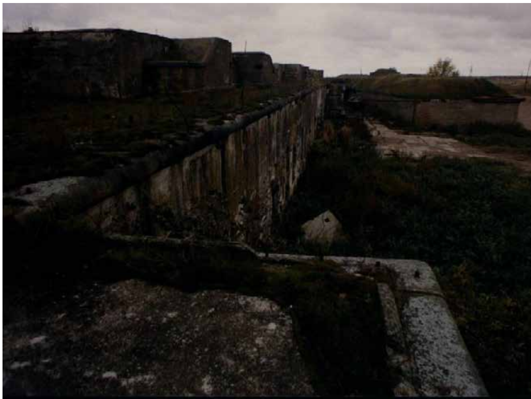
Илл. 25. Форт «Константин». Центральная часть. Батарея казематированная 2-х ярусная «Брылкин» 1898 - 1901 гг. Второй ярус, валганг. Вид с востока. Натурная съемка: сентябрь 1998 г. Фото В. П. Орлова. Архив КГИОП. № 929. Паспорт.
