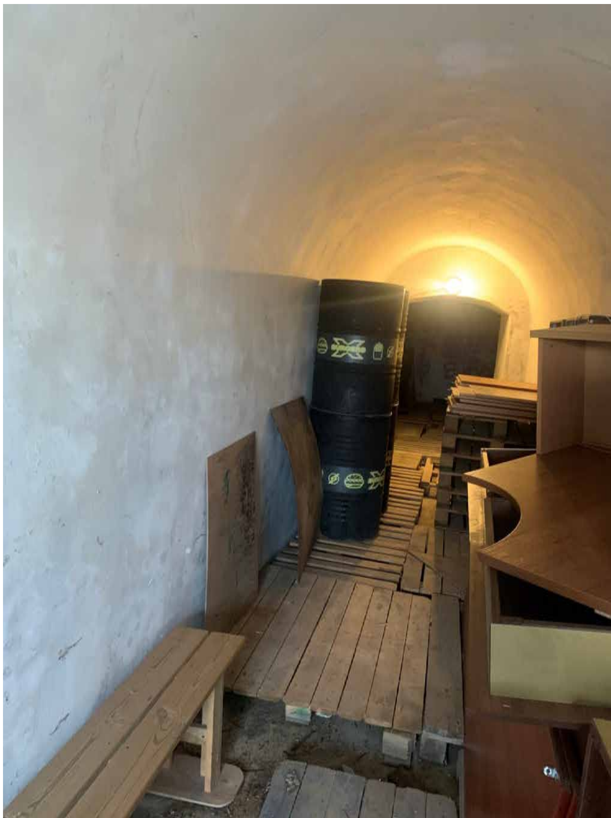
Фото 30. Внутренние помещения 1-го яруса центральной части (центральной оборонительной позиции форта) объекта культурного наследия федерального значения «Форт «Константин» – Батареи казематированной 2-х ярусной «Брылкин» на восемь 6-ти дюймовых (152 мм) орудий, 1898-1901 гг.
