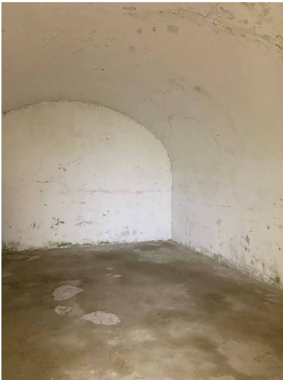
Фото 38. Внутренние помещения 1-го яруса центральной части (центральной оборонительной позиции форта) объекта культурного наследия федерального значения «Форт «Константин» – Батареи казематированной 2-х ярусной «Брылкин» на восемь 6-ти дюймовых (152 мм) орудий, 1898-1901 гг.
