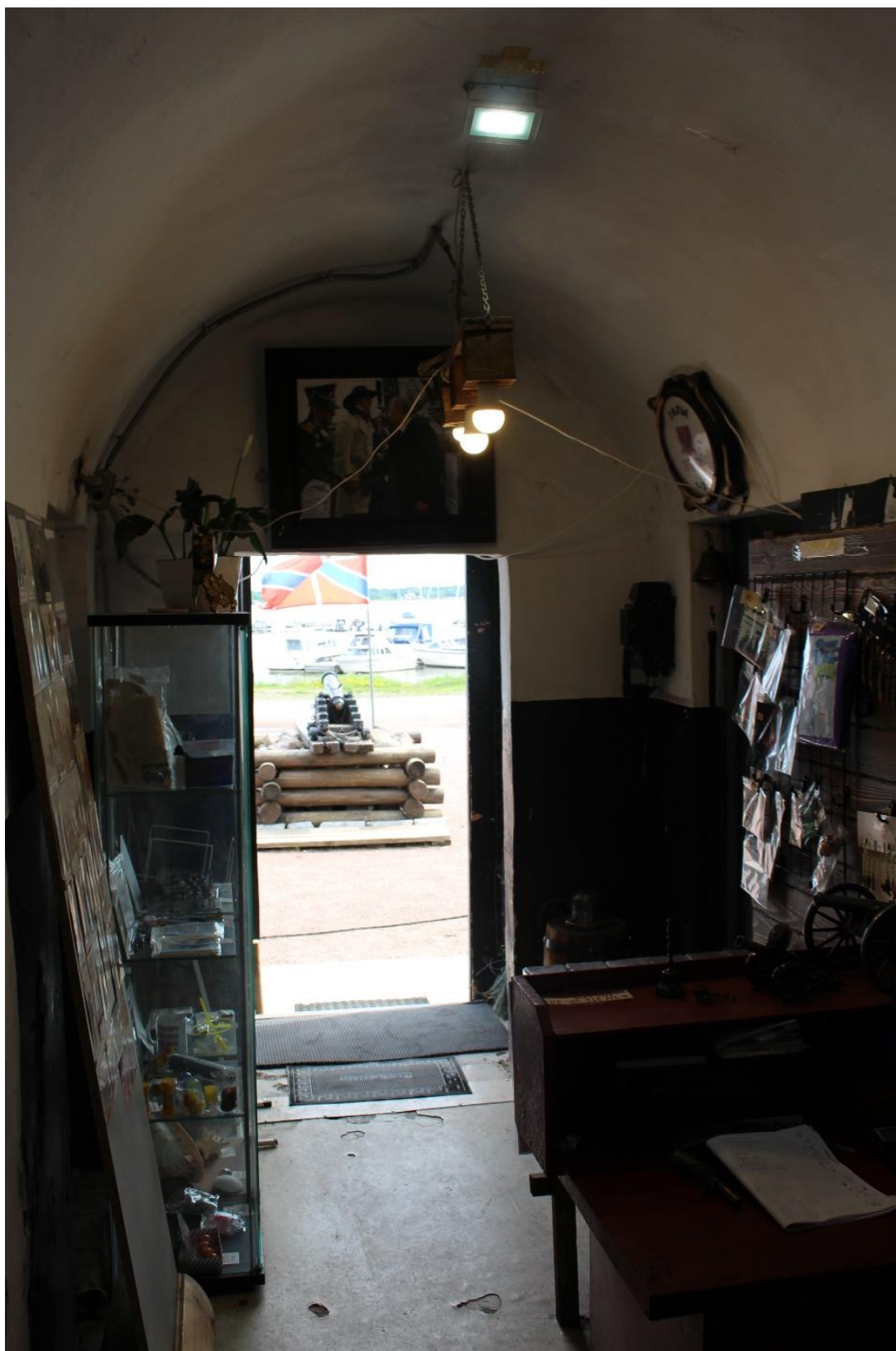
Фото 42. Внутренние помещения 1-го яруса центральной части (центральной оборонительной позиции форта) объекта культурного наследия федерального значения «Форт «Константин» – Батареи казематированной 2-х ярусной «Брылкин» на восемь 6-ти дюймовых (152 мм) орудий, 1898-1901 гг.
