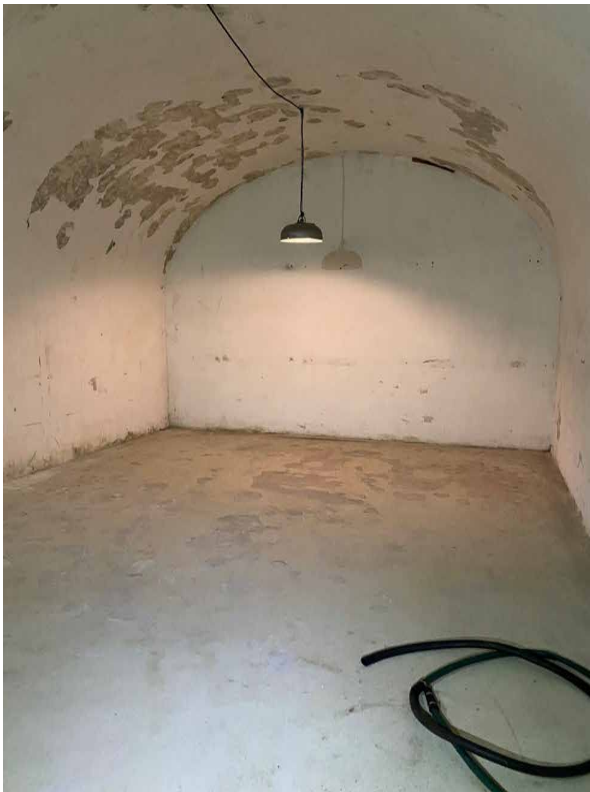
Фото 40. Внутренние помещения 1-го яруса центральной части (центральной оборонительной позиции форта) объекта культурного наследия федерального значения «Форт «Константин» – Батареи казематированной 2-х ярусной «Брылкин» на восемь 6-ти дюймовых (152 мм) орудий, 1898-1901 гг.
