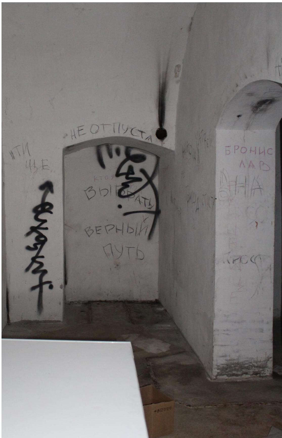
Фото 31. Внутренние помещения 1-го яруса центральной части (центральной оборонительной позиции форта) объекта культурного наследия федерального значения «Форт «Константин» – Батареи казематированной 2-х ярусной «Брылкин» на восемь 6-ти дюймовых (152 мм) орудий, 1898-1901 гг.
