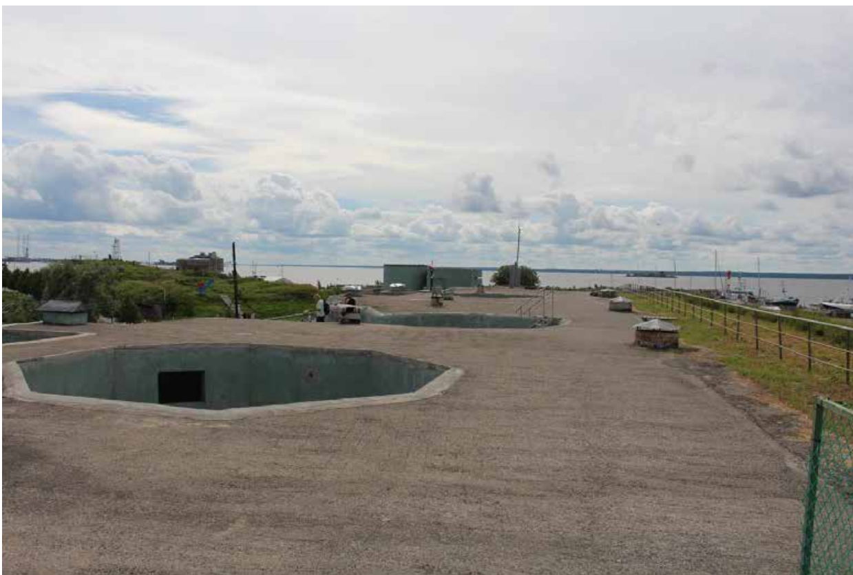
Фото 23. Вид на валганг центральной части (центральной оборонительной позиции форта) объекта культурного наследия федерального значения «Форт «Константин» – Батареи казематированной 2-х ярусной «Брылкин» на восемь 6-ти дюймовых (152 мм) орудий, 1898-1901 гг.
