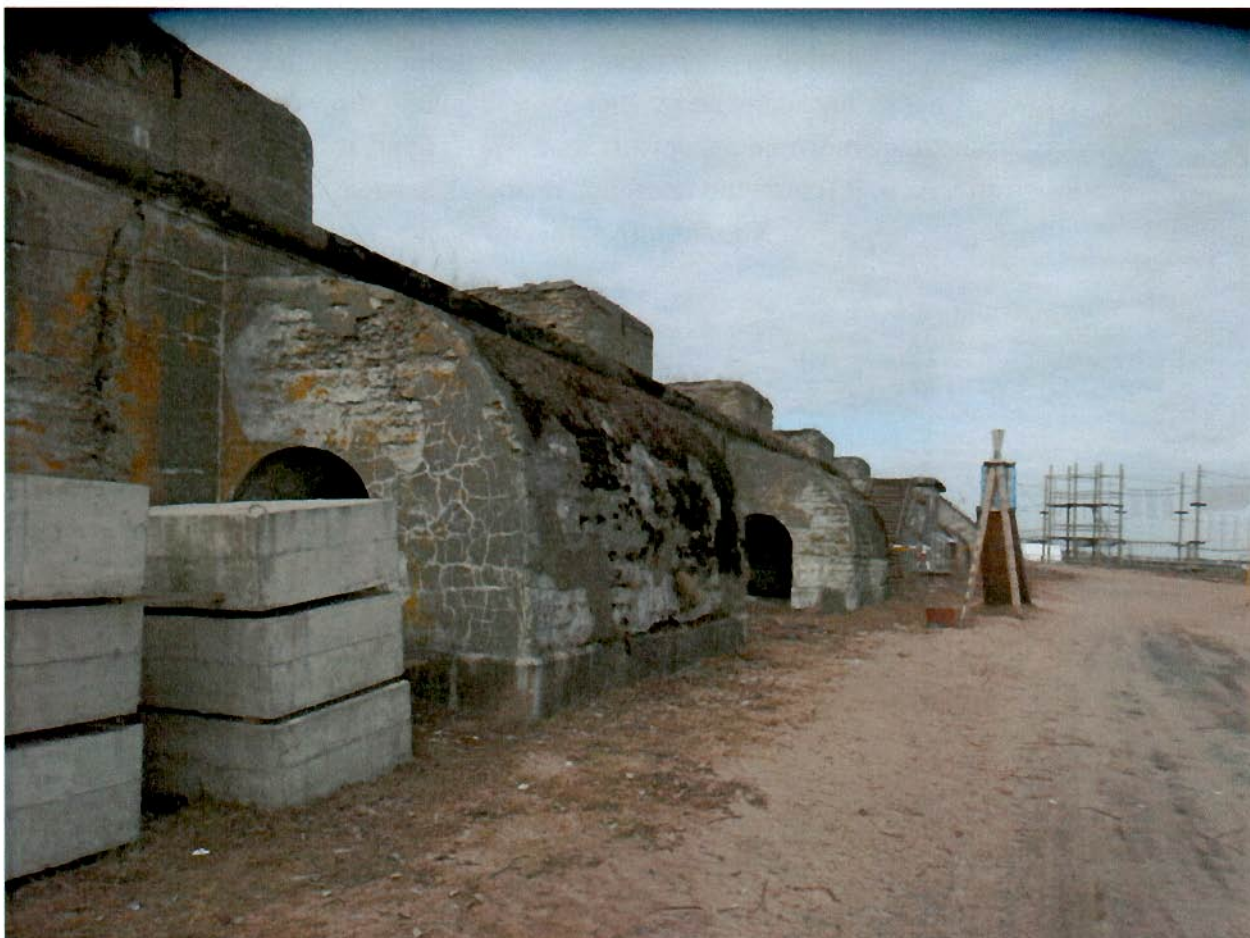
2. Бетонные двухэтажные казематированные траверсы с валгангами.
