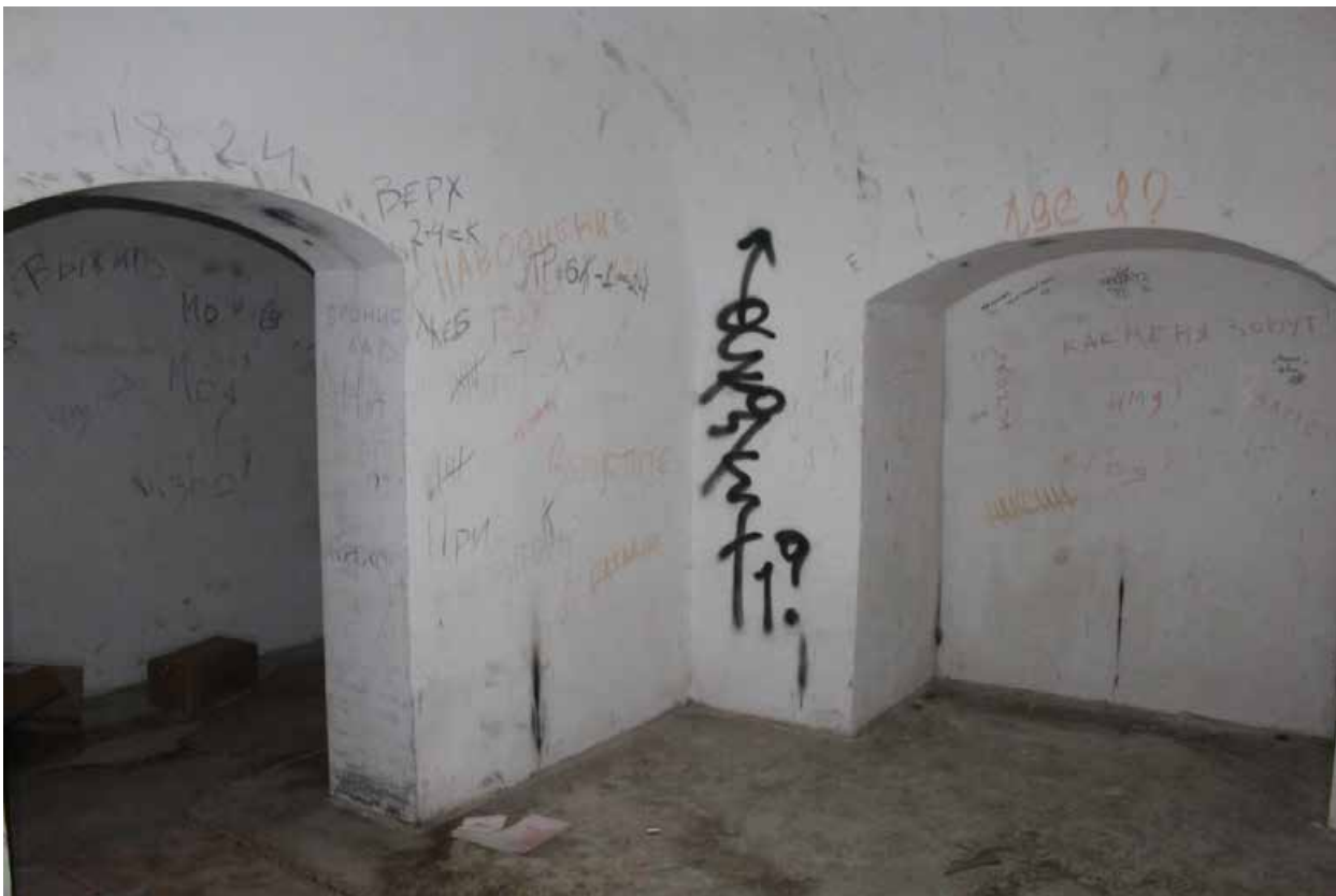
Фото 32. Внутренние помещения 1-го яруса центральной части (центральной оборонительной позиции форта) объекта культурного наследия федерального значения «Форт «Константин» – Батареи казематированной 2-х ярусной «Брылкин» на восемь 6-ти дюймовых (152 мм) орудий, 1898-1901 гг.
