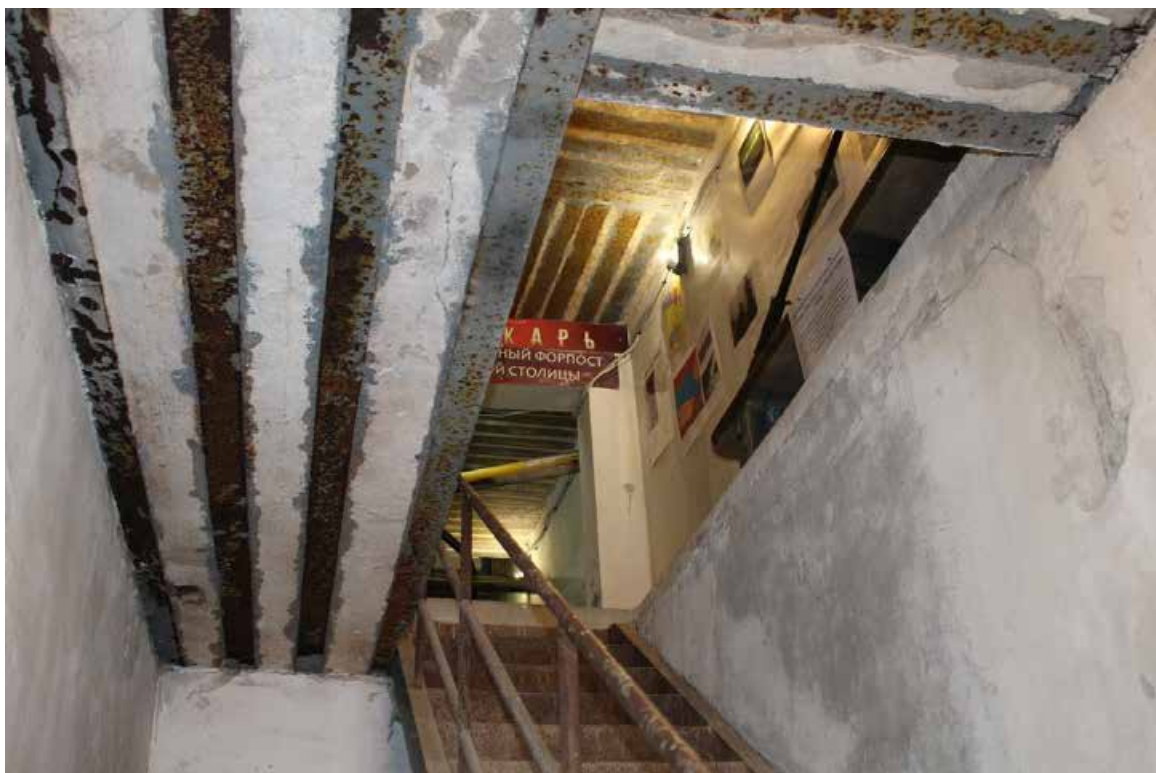
Фото 45. Внутренние помещения 1-го яруса центральной части (центральной оборонительной позиции форта) объекта культурного наследия федерального значения «Форт «Константин» – Батареи казематированной 2-х ярусной «Брылкин» на восемь 6-ти дюймовых (152 мм) орудий, 1898-1901 гг.
