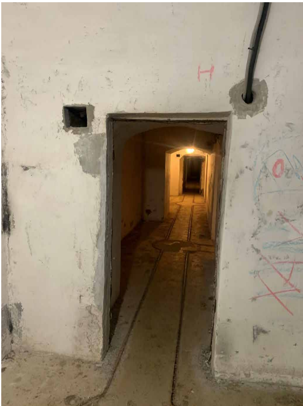
Фото 34. Внутренние помещения 1-го яруса центральной части (центральной оборонительной позиции форта) объекта культурного наследия федерального значения «Форт «Константин» – Батареи казематированной 2-х ярусной «Брылкин» на восемь 6-ти дюймовых (152 мм) орудий, 1898-1901 гг.
