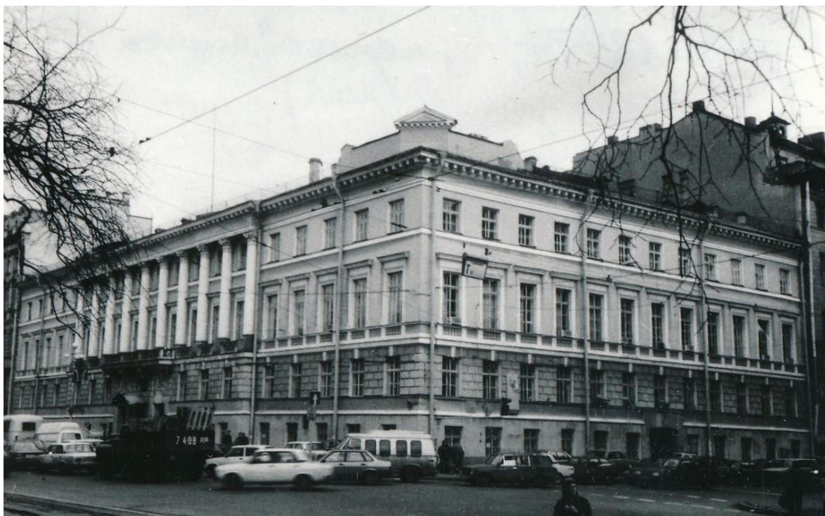
Илл. 16. Здание по Адмиралтейскому пр., 6/ул. Гороховой, 2, - бывш. Дом губернских присутственных мест. Фото (копия) 1995 г. (автор – А. Агафонов).
