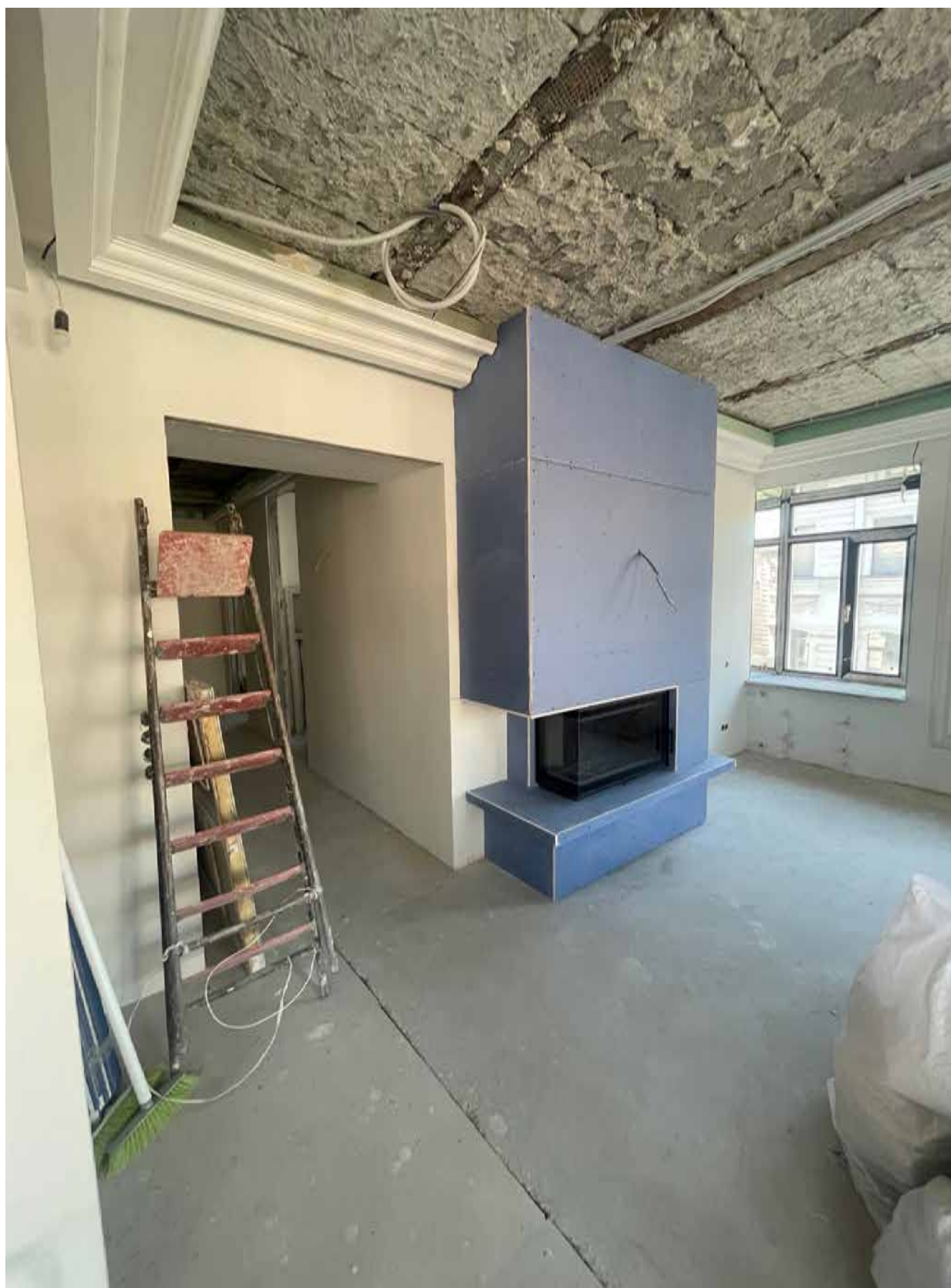
18.Фрагмент интерьера комнаты (помещение 7/29.3; 8/18.1);
