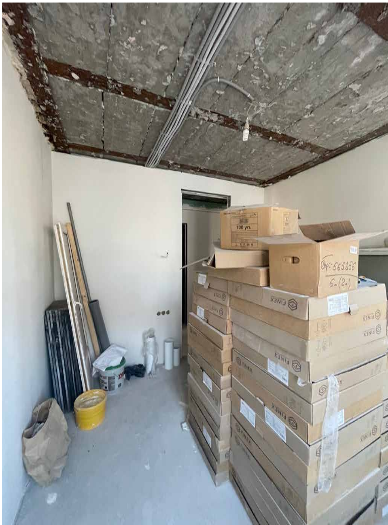
13. Фрагмент интеръера комнат (помещение 6/22.4);
