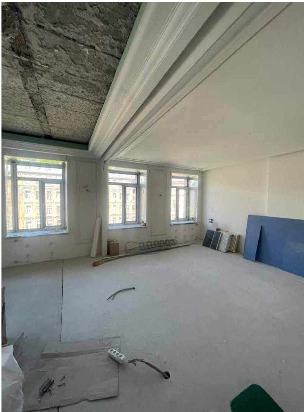
15.Фрагмент интерьера комнаты (помещение 7/29.3; 8/18.1);
