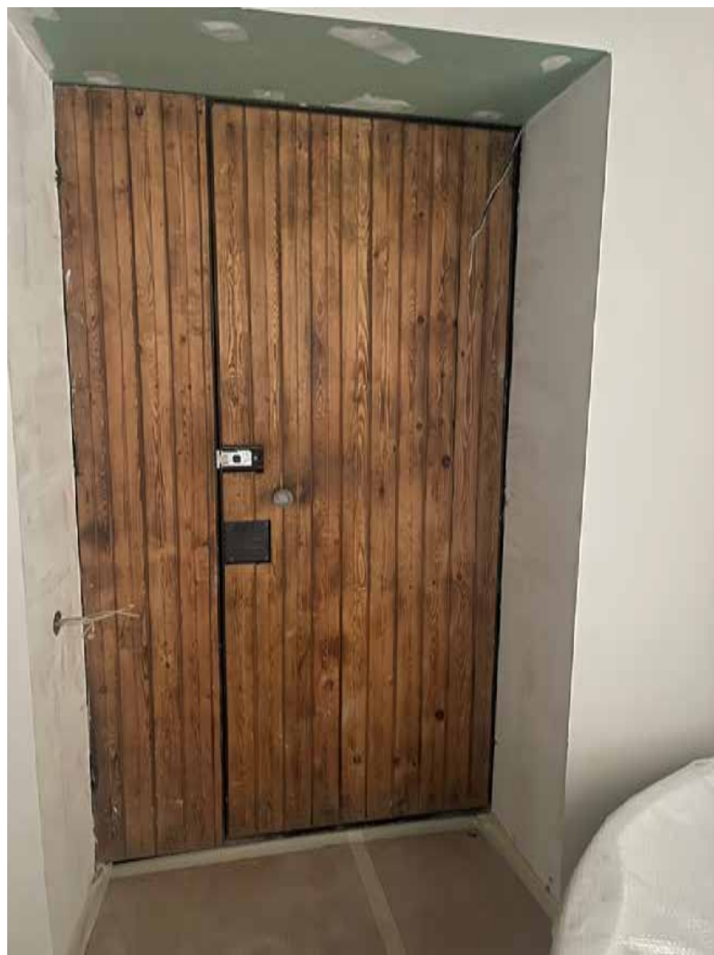
6. Вид на входную дверь в квартире;
