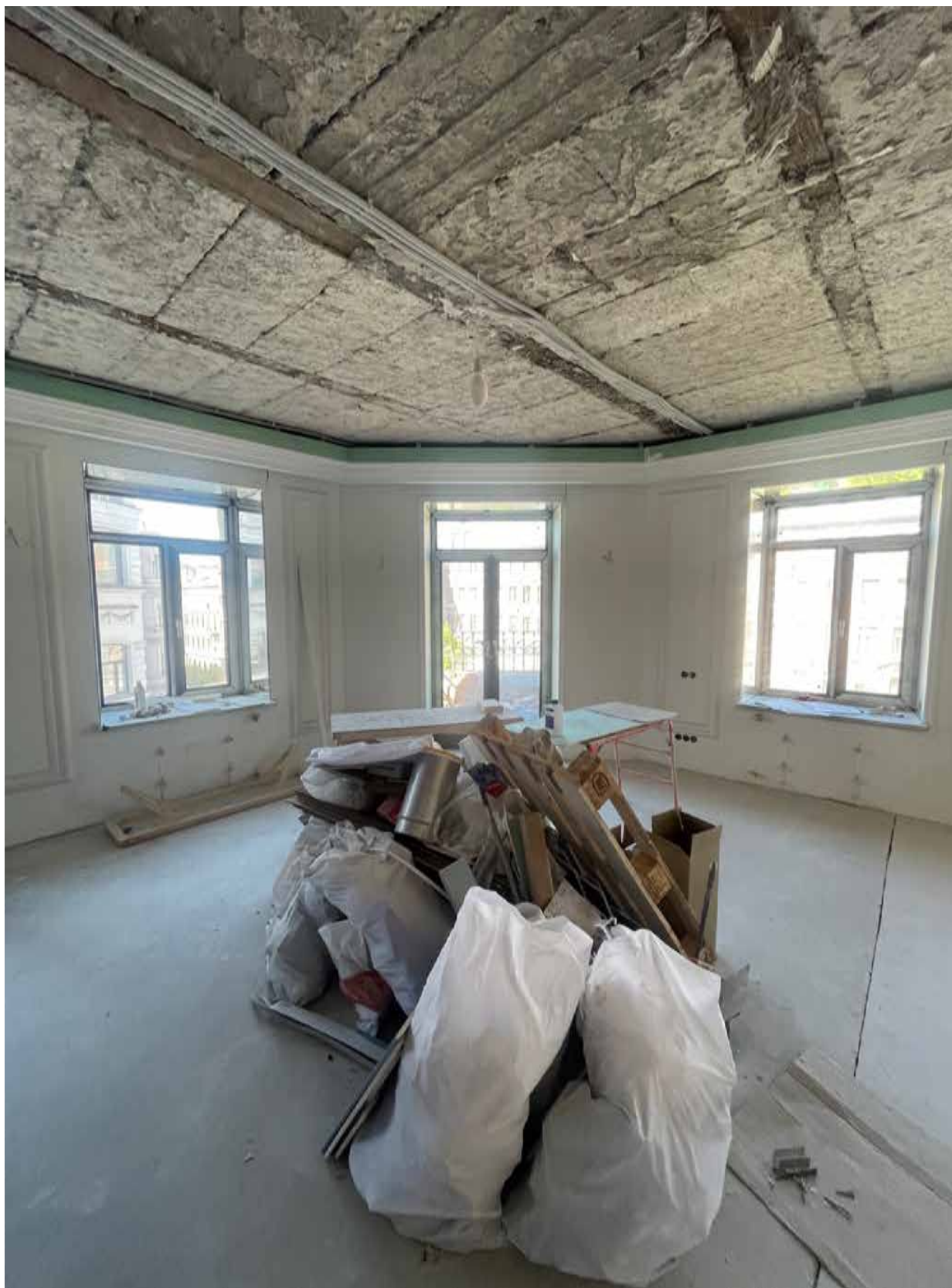
14.Фрагмент интерьера комнаты (помещение 7/29.3; 8/18.1);
