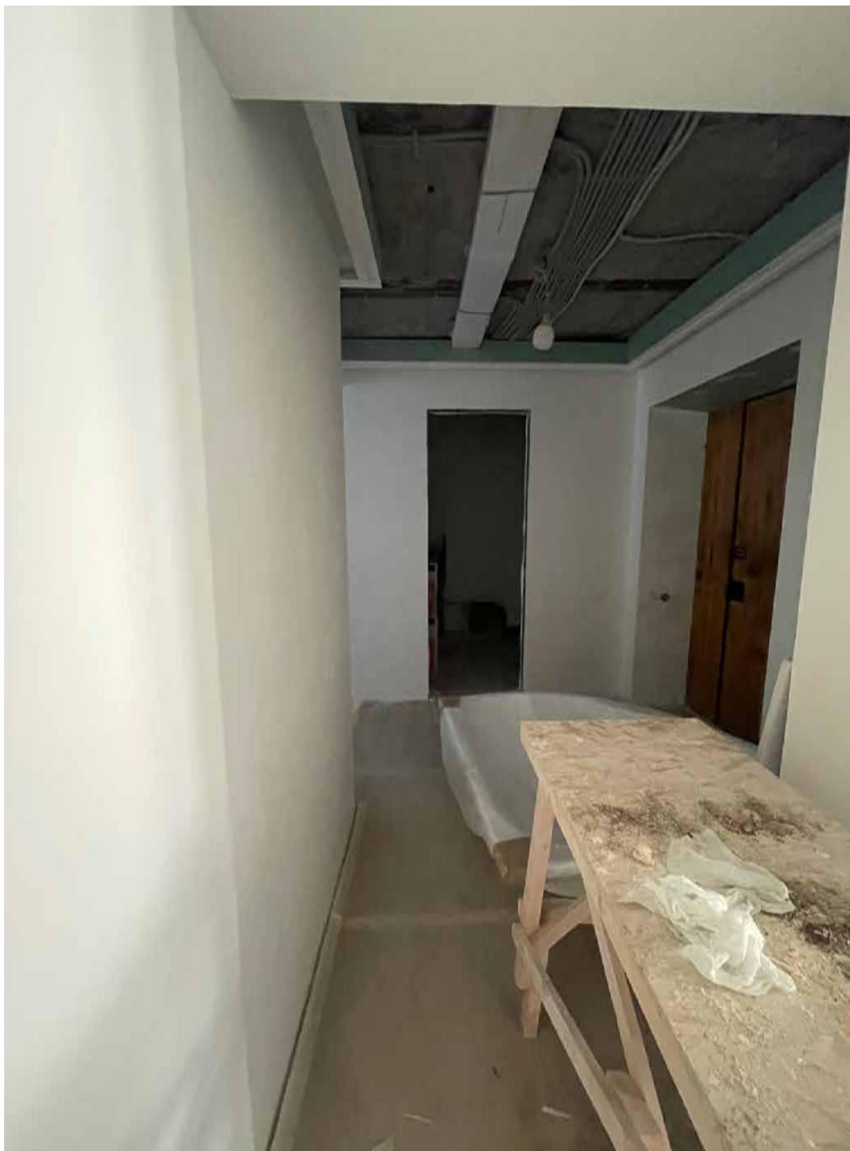
10.Фрагмент интерьера коридора (помещение 1/18.5);
