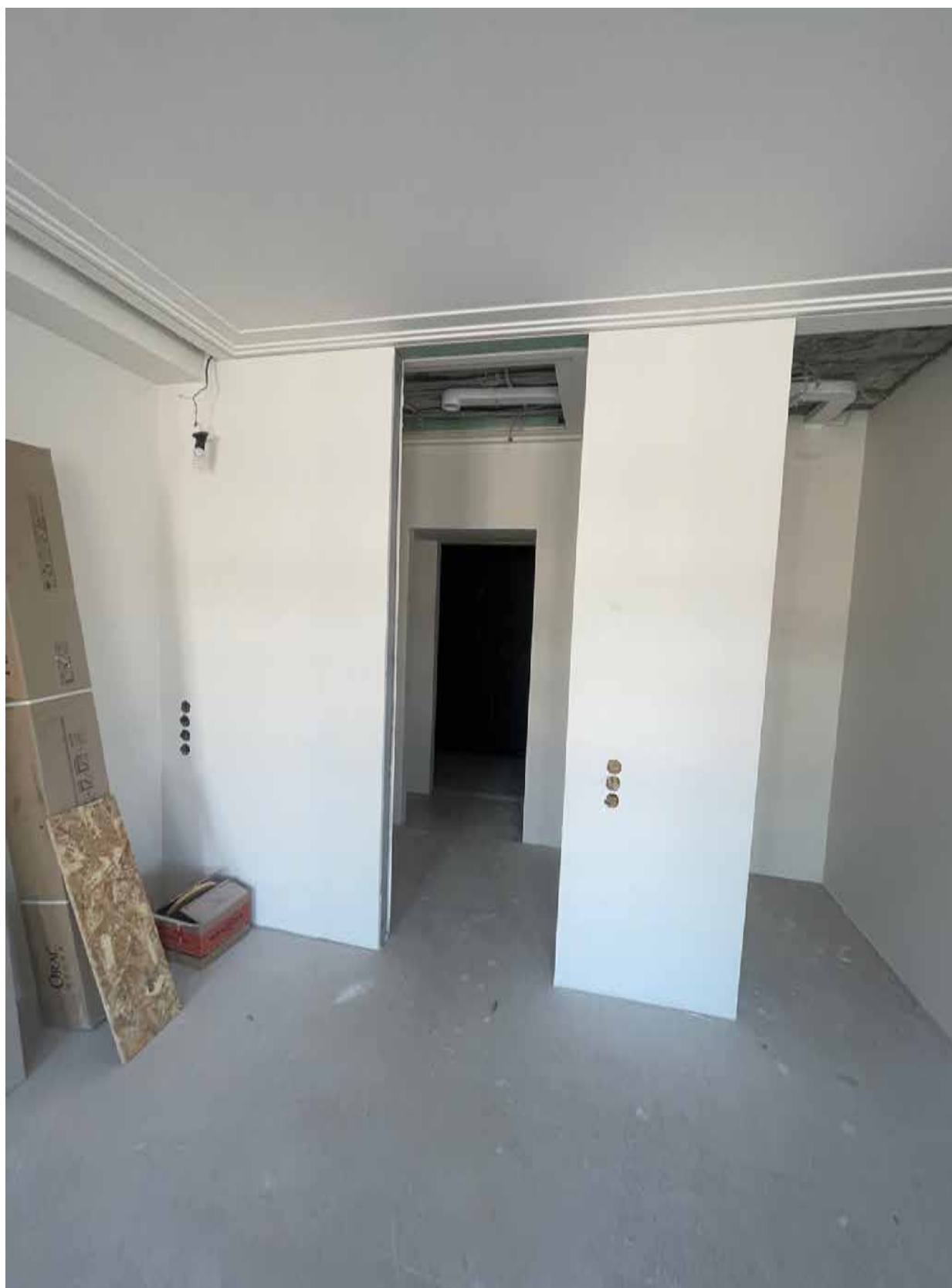
19.Фрагмент интерьера комнаты (помещение 7/29.3; 8/18.1);
