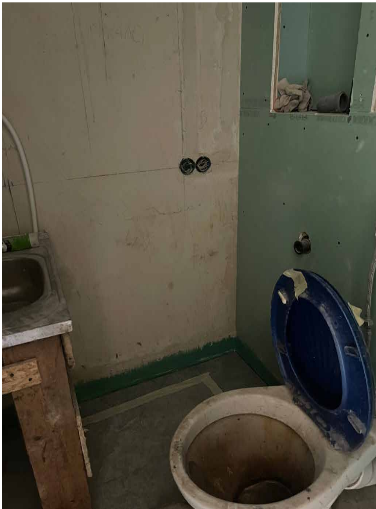
7. Фрагмент интерьера туалета (помещение 4/1.3);
