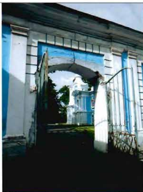
7. (Воротный проезд в юго-западной части ограды)
