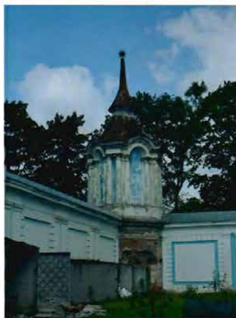
8. (Северо-западный угол ограды)
