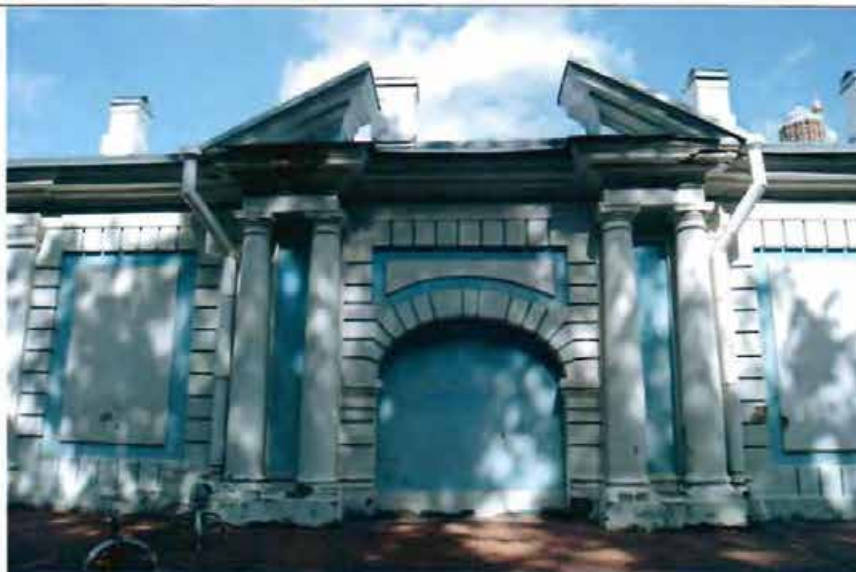
1. (Фрагмент южного фасада ограды)
