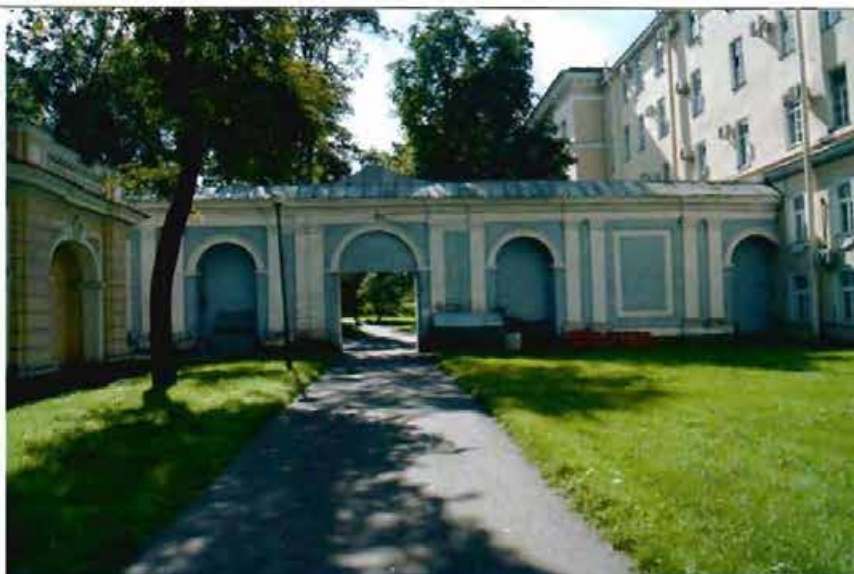
6. (Фрагмент юго-восточной части ограды)
