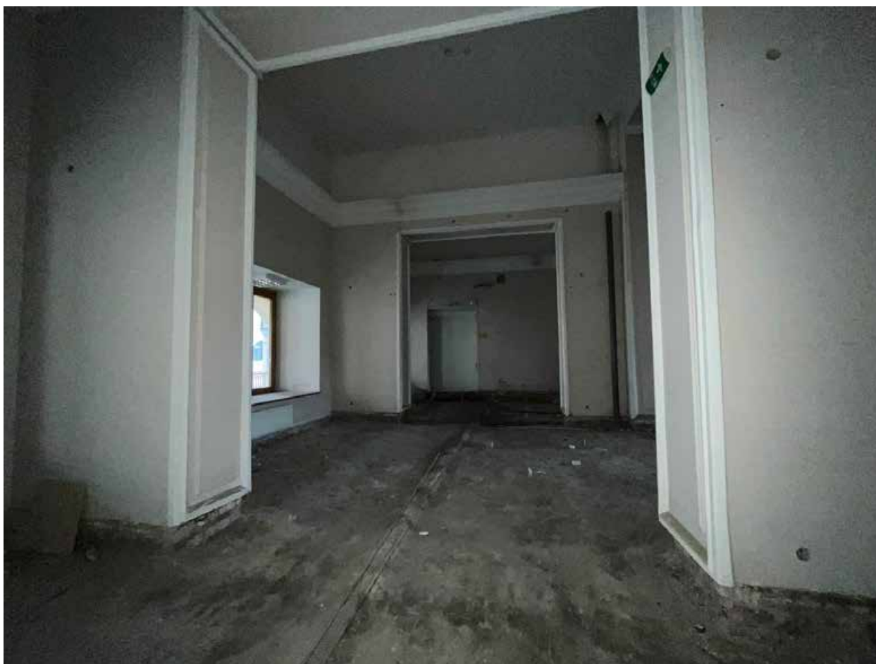
Фото №24. Второй этаж. Общий вид помещений.
