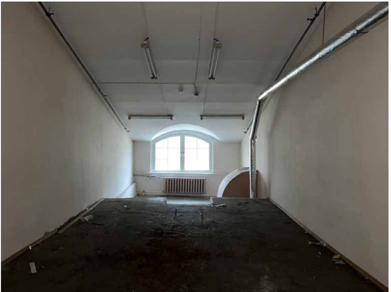
Фото №38. Помещение третьего этажа (мансарда).
