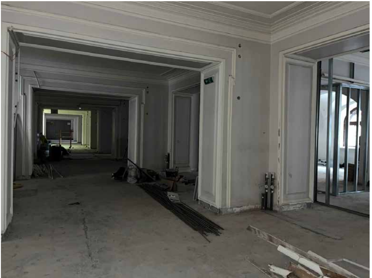
Фото №11. Первый этаж. Галерея, вдоль стены лицевого фасада.
