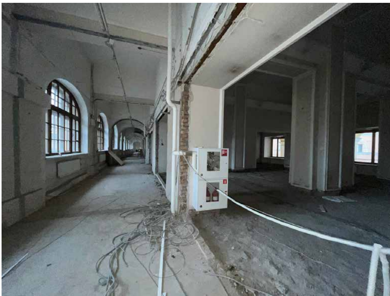
Фото №23. Второй этаж. Общий вид помещений.
