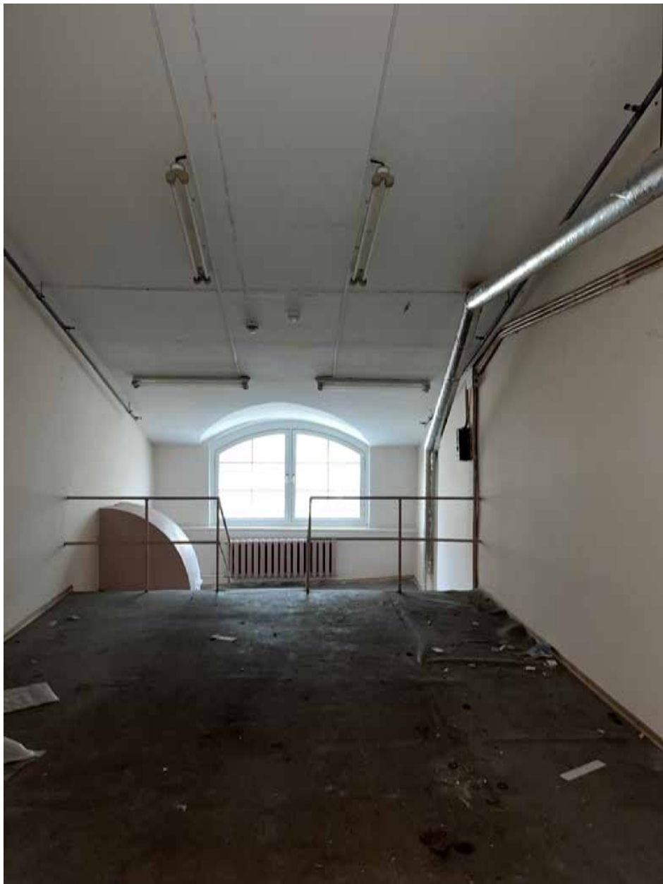
Фото №34. Помещение третьего этажа (мансарда).
