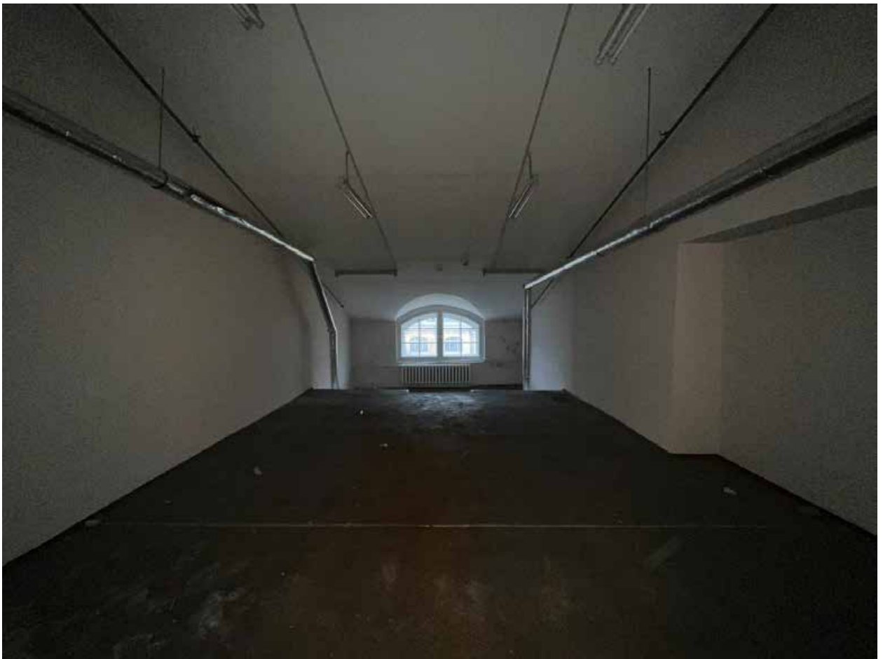
Фото №46. Помещение третьего этажа (мансарда).
