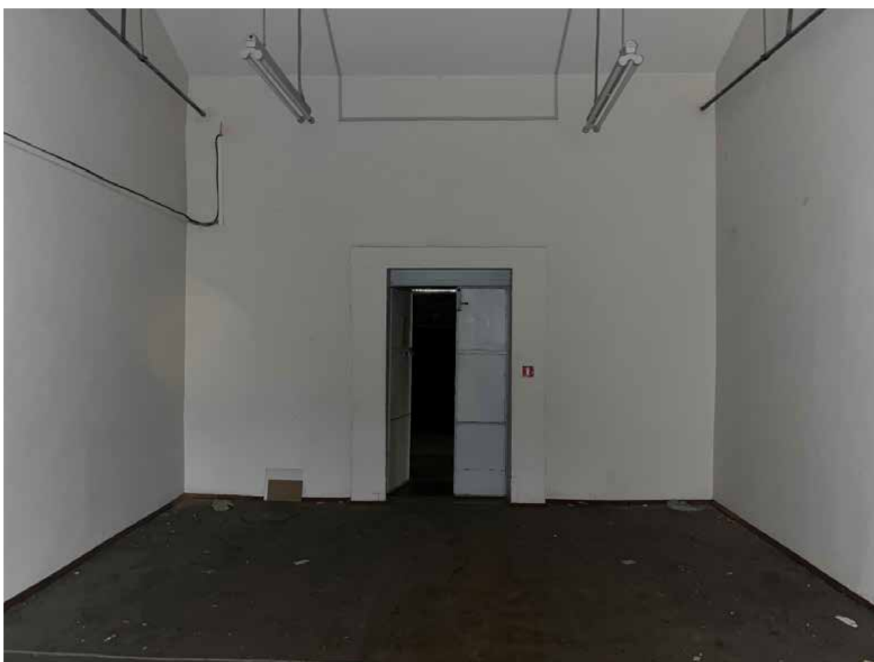
Фото №45. Помещение третьего этажа (мансарда).
