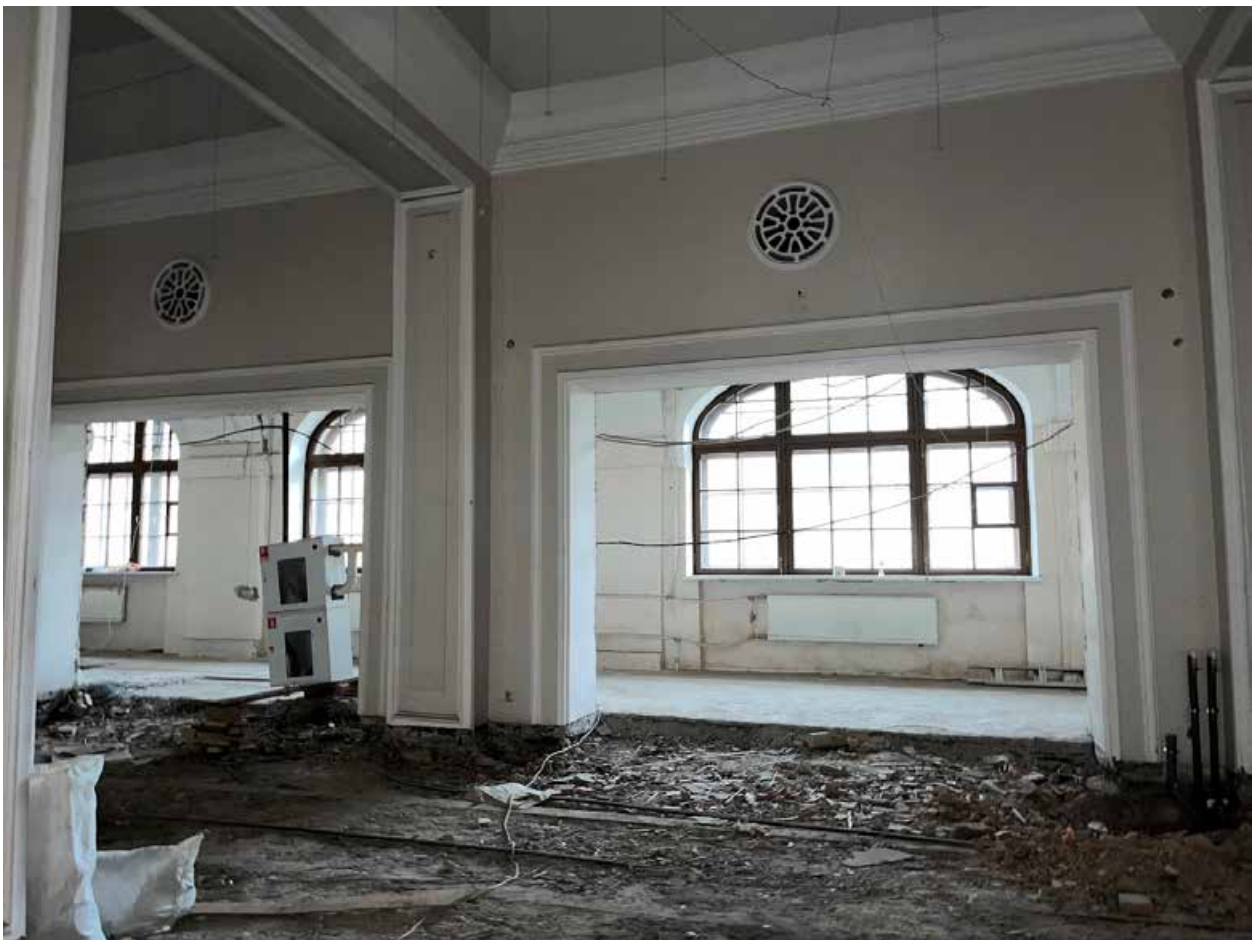
Фото №19. Второй этаж. Общий вид помещений.
