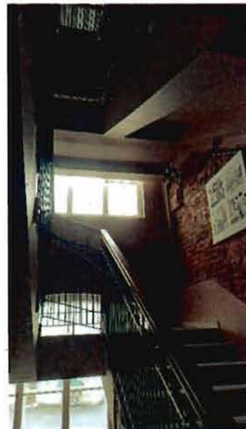
7. Лестница. (Невский пр-кт, дом 35, лит. В)
