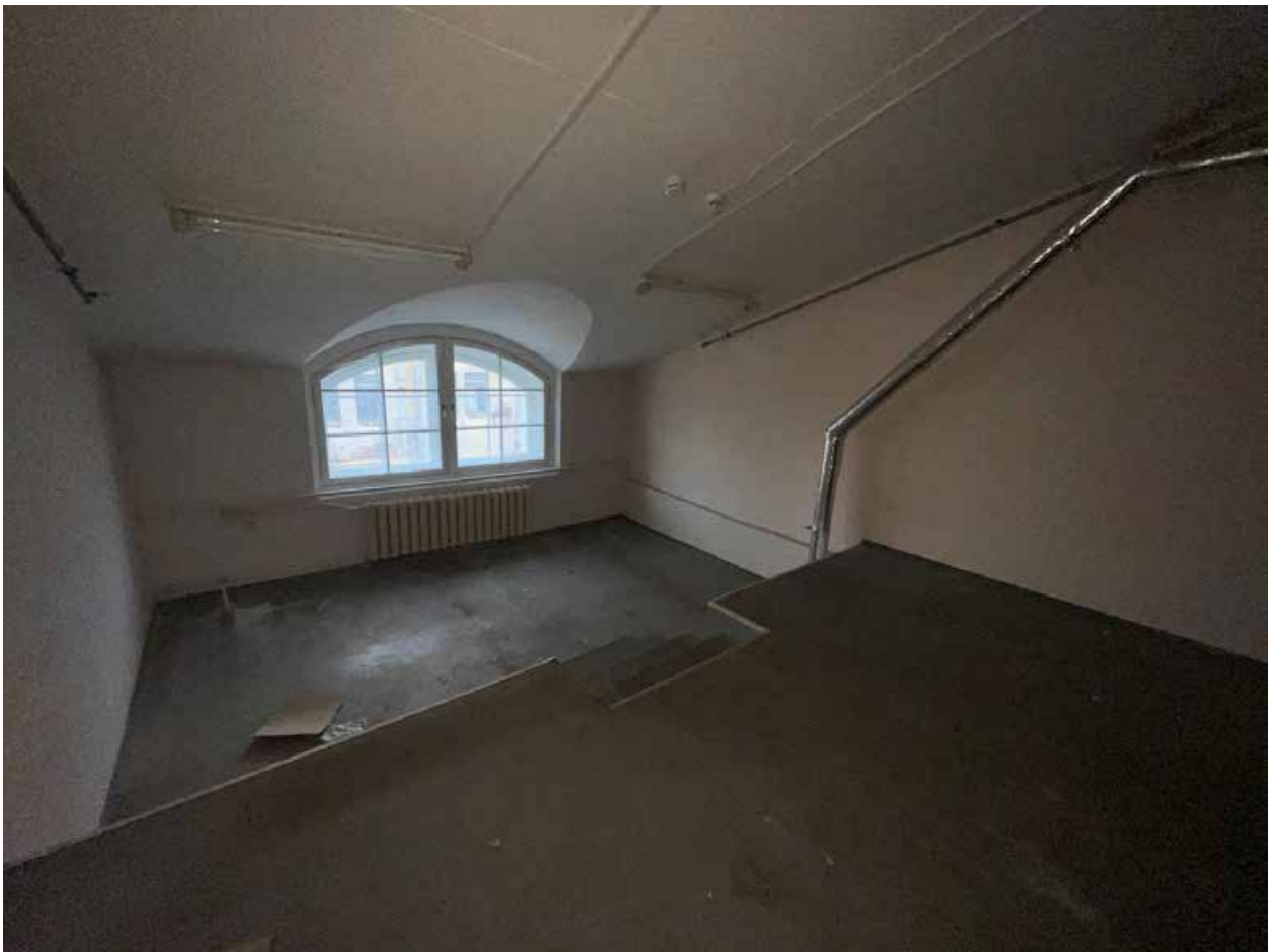
Фото №43. Помещение третьего этажа (мансарда).
