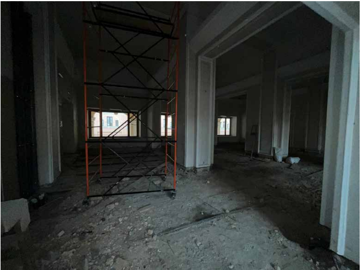
Фото №16. Второй этаж. Общий вид помещений.
