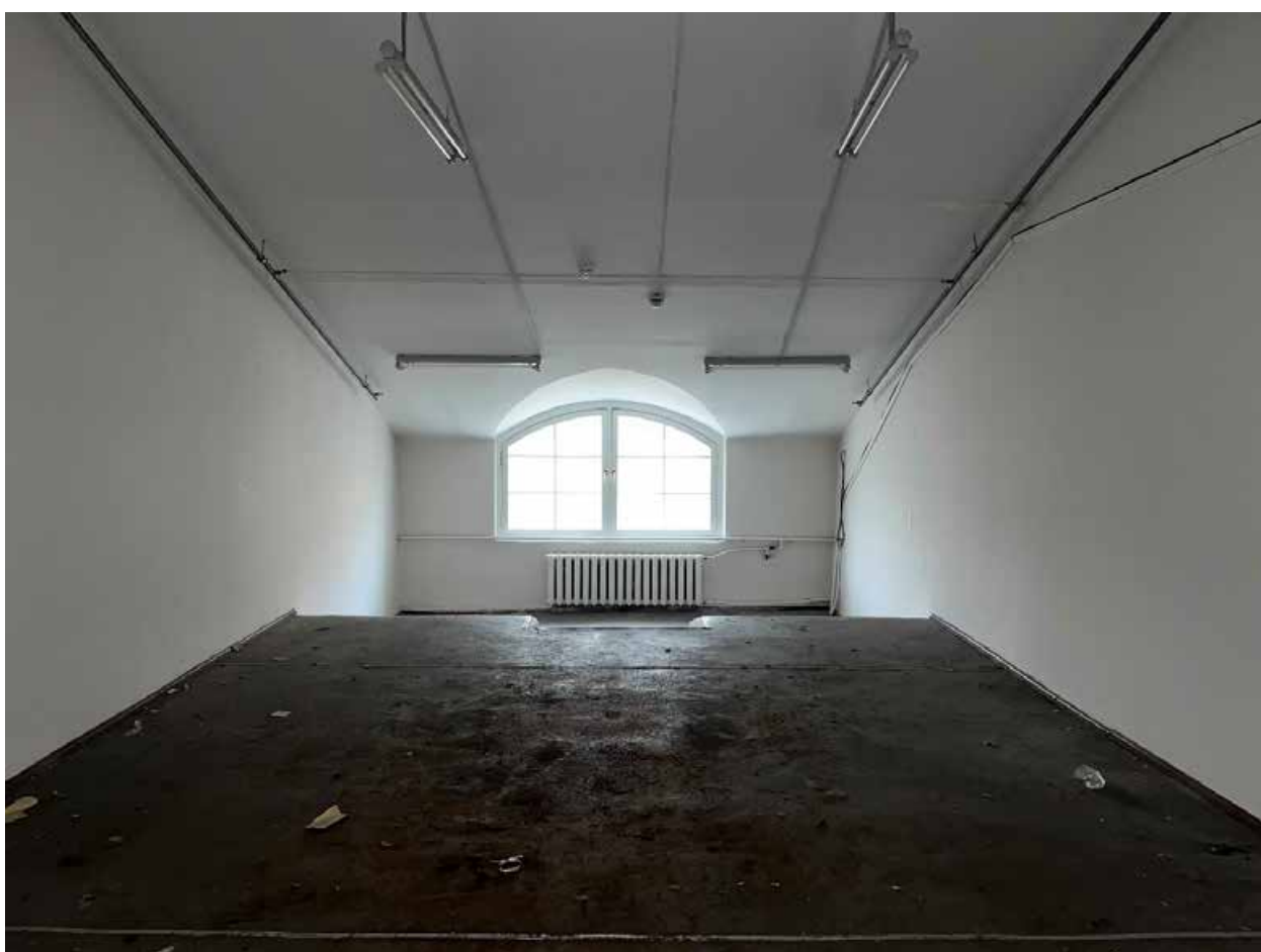
Фото №44. Помещение третьего этажа (мансарда).
