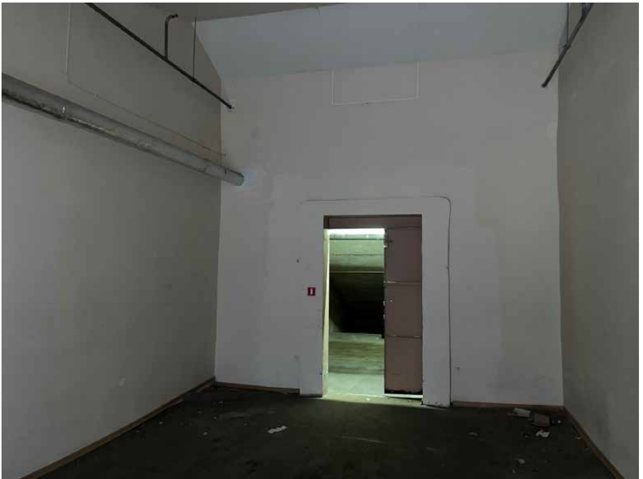
Фото №39. Помещение третьего этажа (мансарда).
