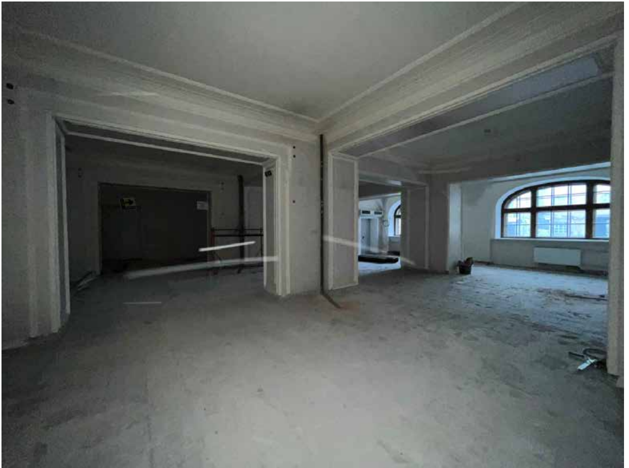
Фото №14. Первый этаж. Общий вид помещений.
