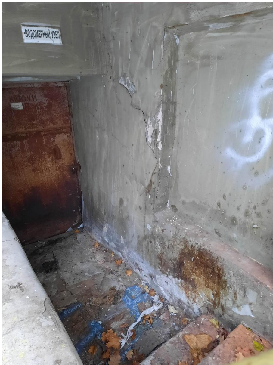
Фото 11. Вход в цокольный этаж со стороны бокового фасада здания.
