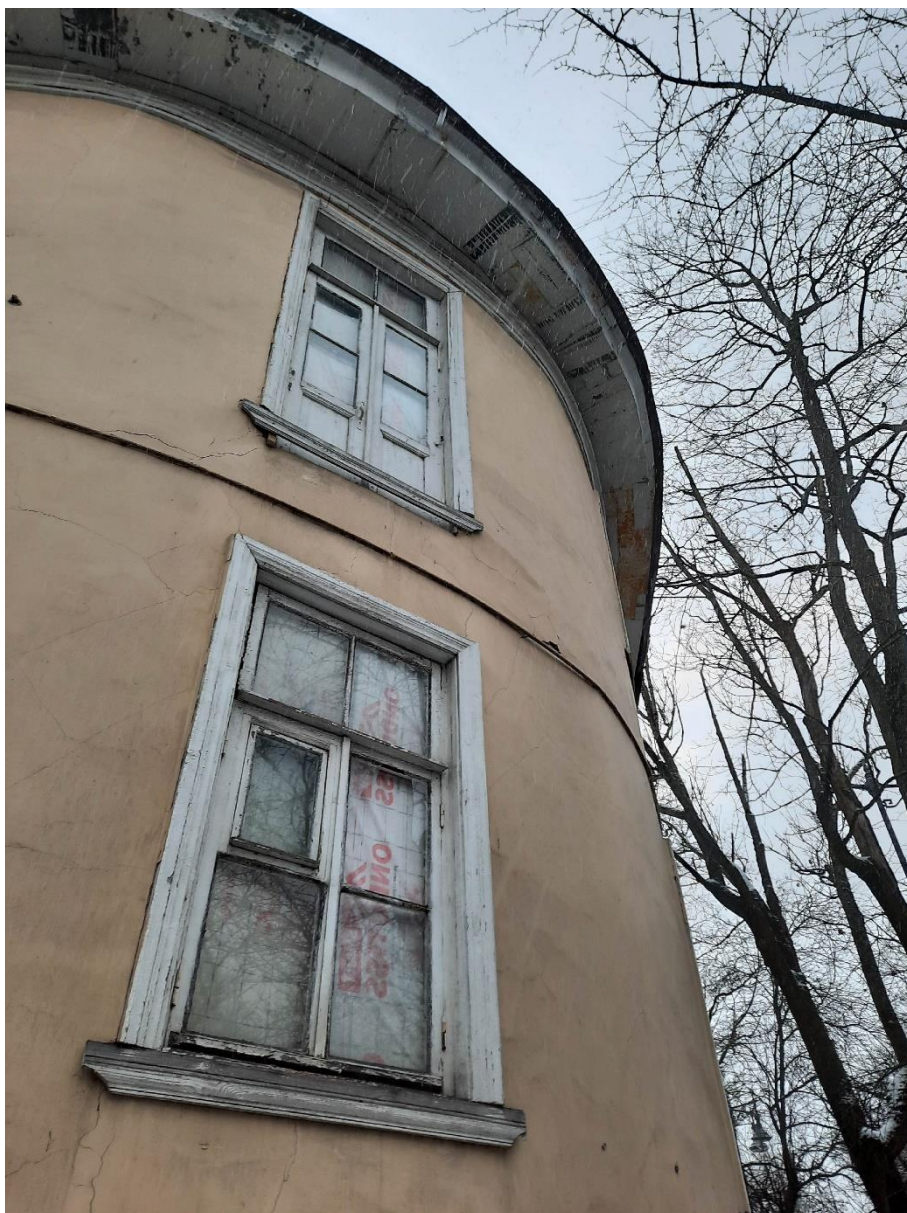
Фото 13. Оконное заполнение 1 и 2 этажей в закругленной северной части здания. На 2 этаже заполнение – балконная дверь.
