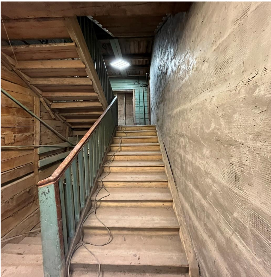
Фото 58. Промежуточная площадка 1ЛК между 1 и 2 этажами. Вид на площадку 2 этажа.
