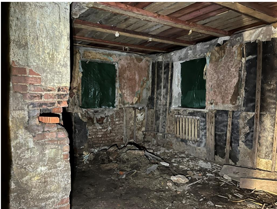
Фото 18. Пом. 2-Н, пом. 4.
