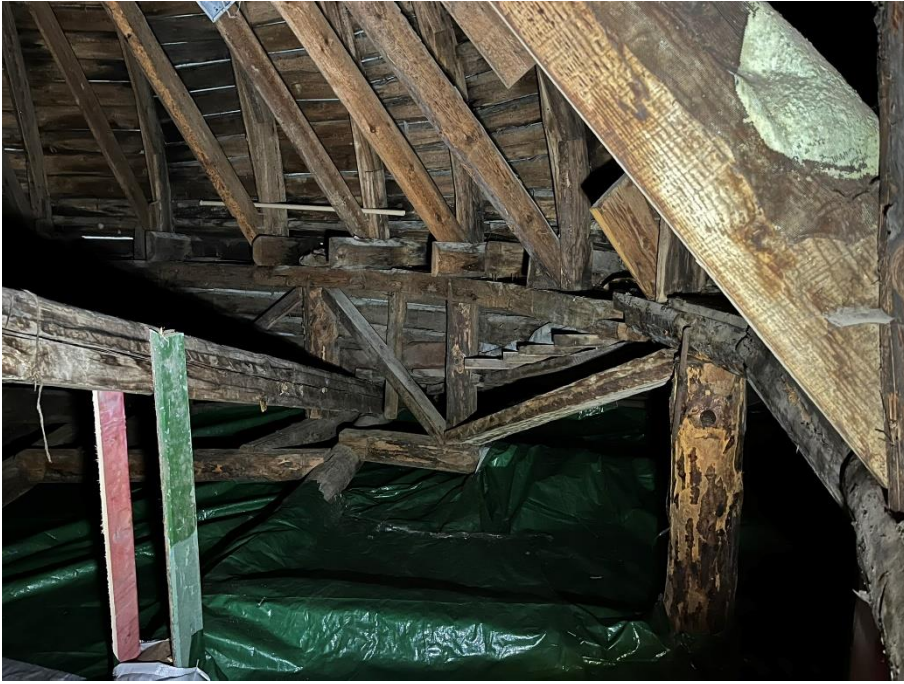
Фото 100. Конструкции купола угловой башни. Правая часть.
