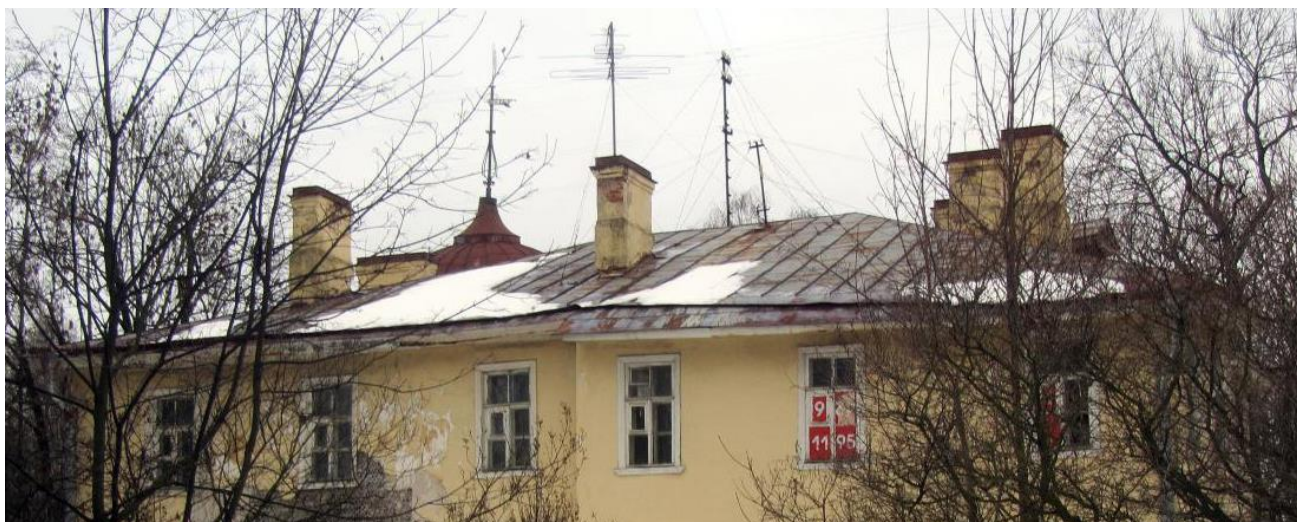
Фото 9. Кровля здания с дымоходами со стороны заднего фасада.
