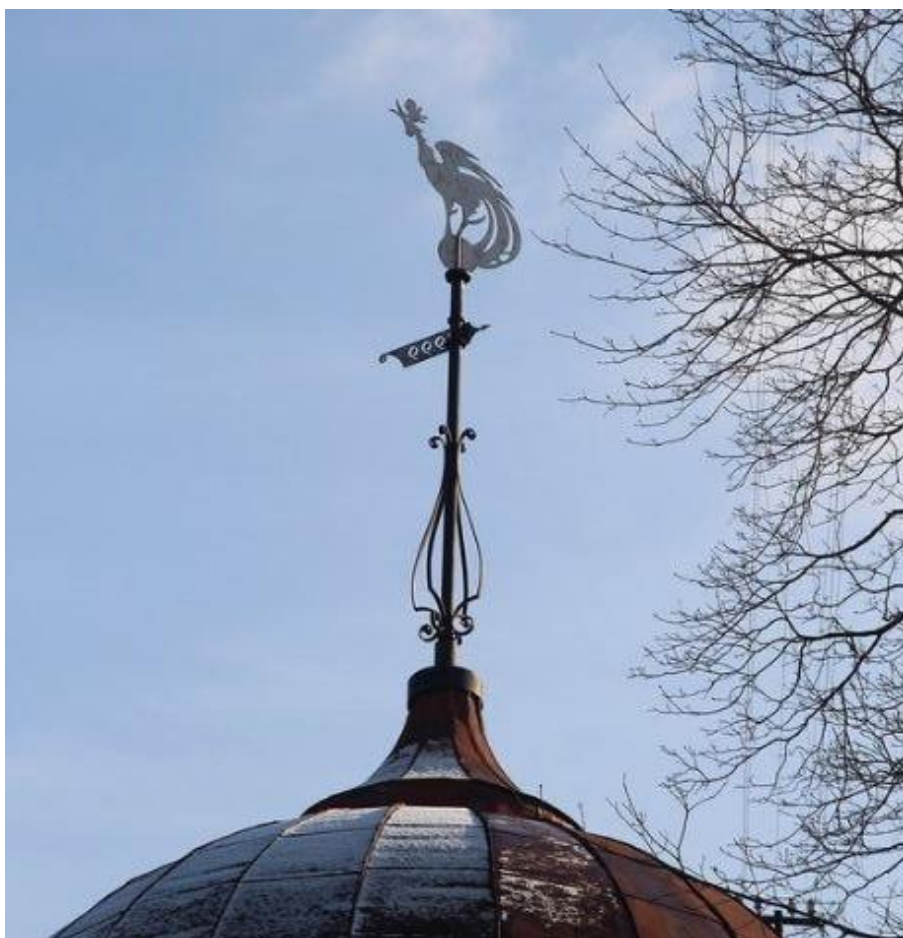
Фото 8. Флюгер на шпиле.
