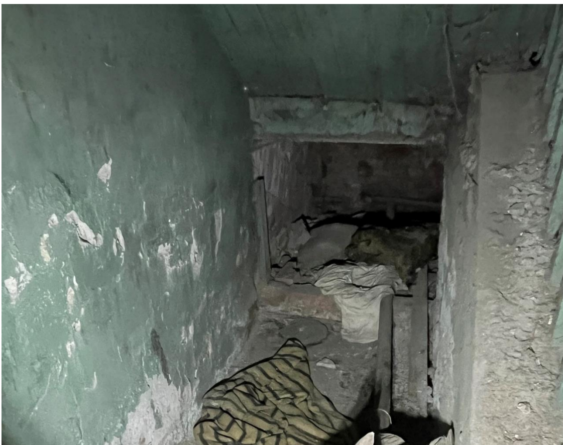
Фото 2. Пом. 2. Подлестничное пространство.
