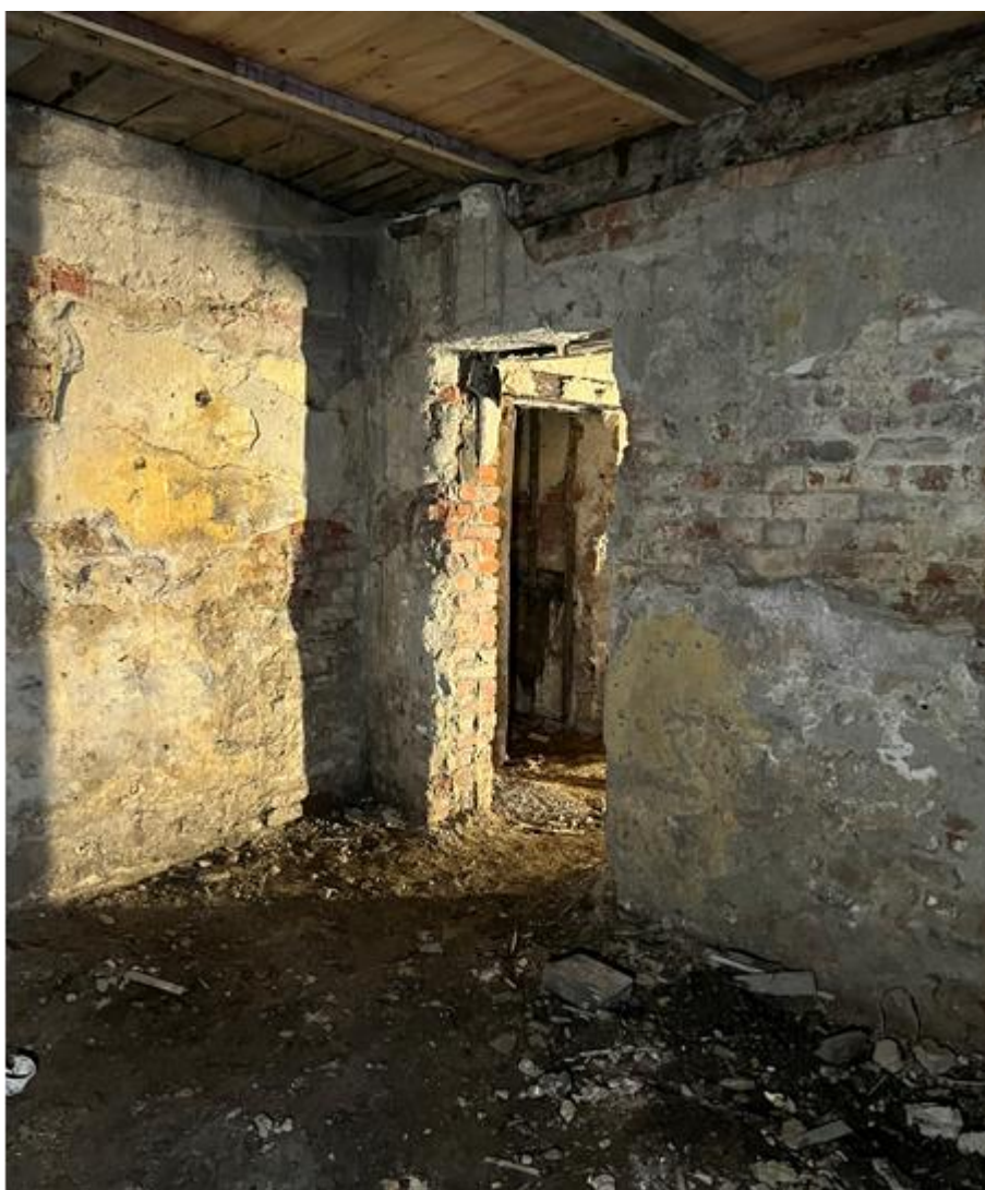
Фото 17. Пом. 2-Н, пом. 3.
