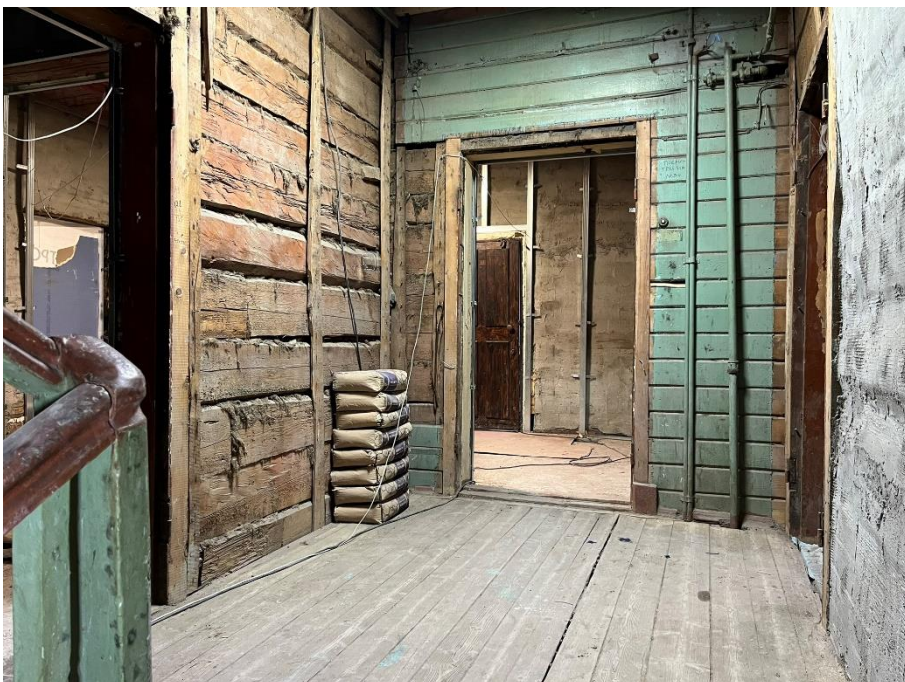
Фото 60. Лестничная площадка 2 этажа 1ЛК.
