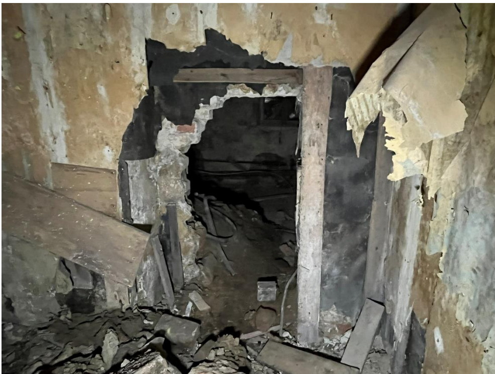
Фото 12. Пом. 3-Н, пом. 6.
