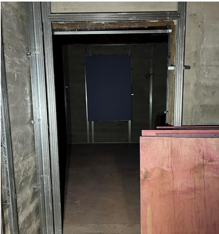
Фото 79. Кв. №7, вид из пом. 5.
