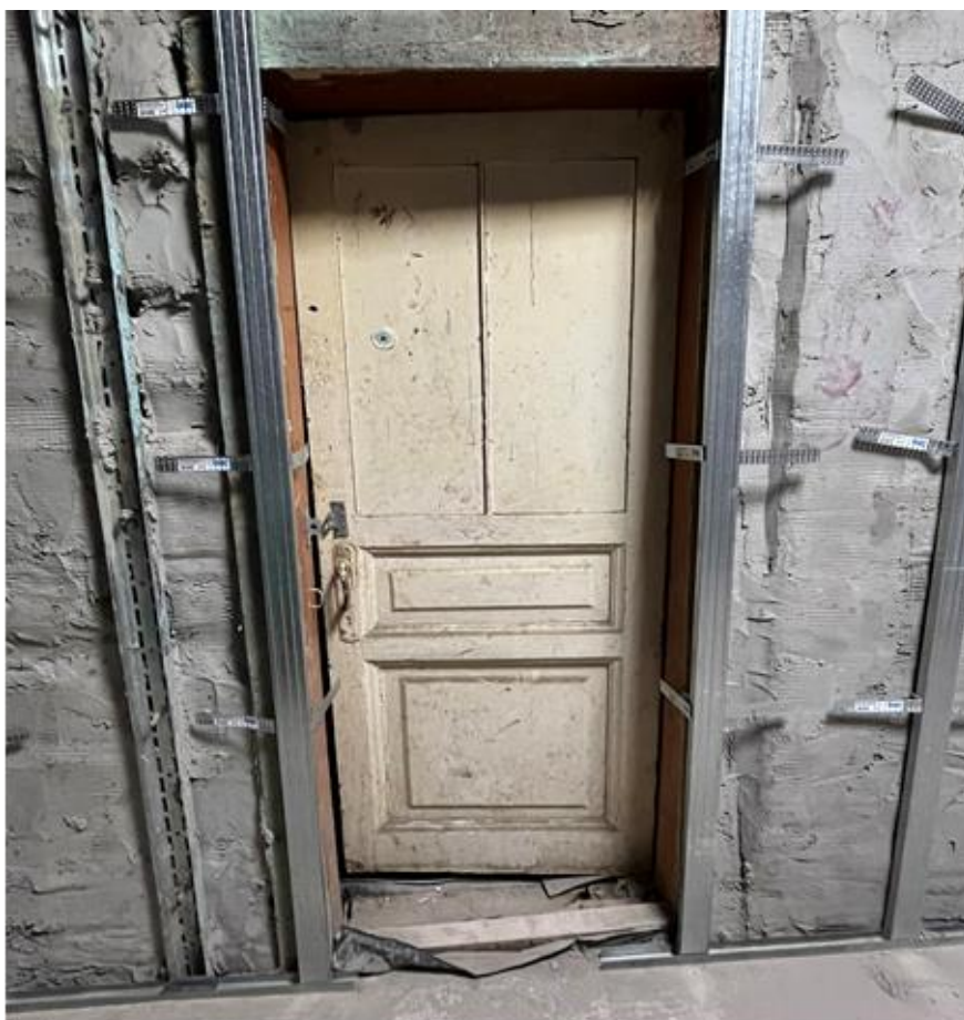
Фото 44. Кв. №4, пом. 1. Вид на пом. 4.
