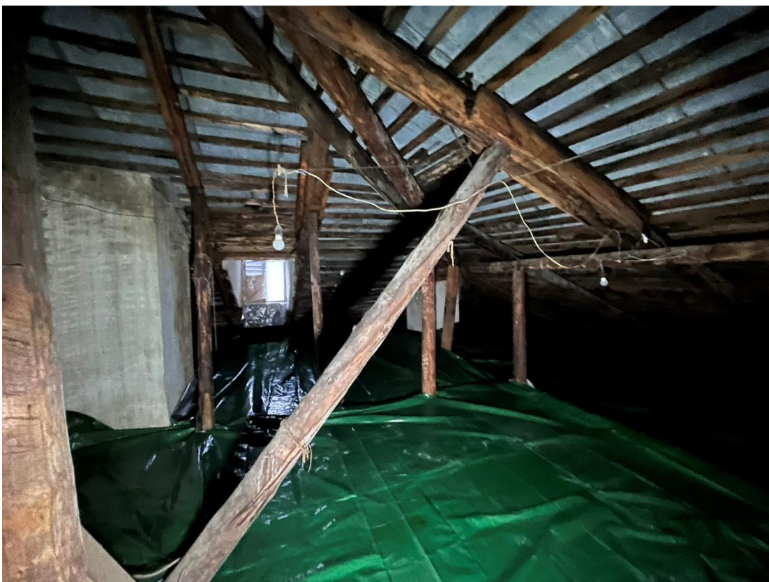
Фото 93. Помещение чердака. Вид на слуховое окно.
