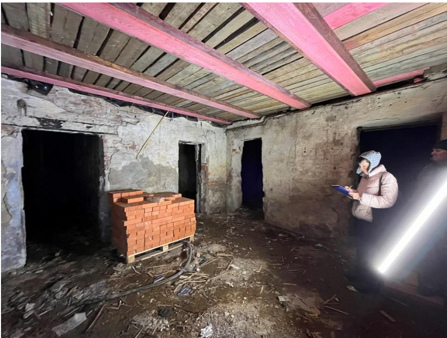
Фото 15. Пом. 2-Н, пом. 1.
