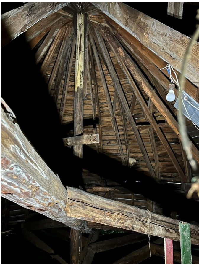
Фото 99. Конструкции купола угловой башни. Центральная часть.
