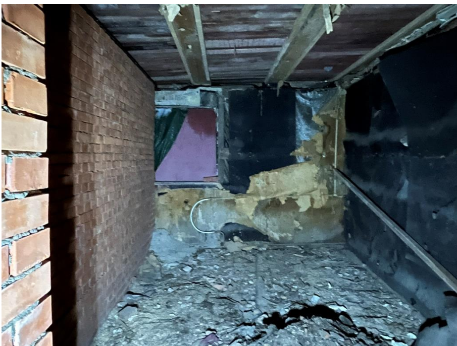
Фото 23. Пом. 2-Н, пом. 8.
