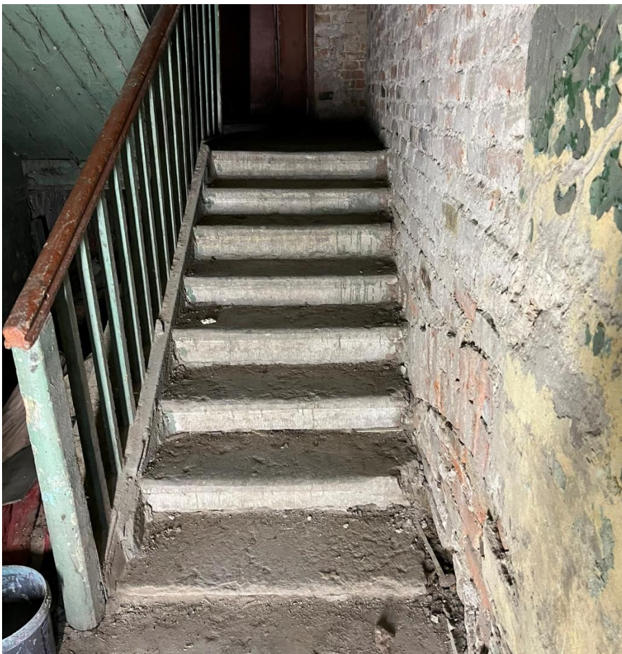
Фото 3. Пом. 2. Лестница, спуск в цокольный этаж.
