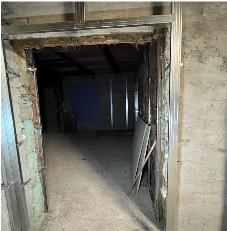
Фото 69. Кв. №6, вид из пом. 8.
