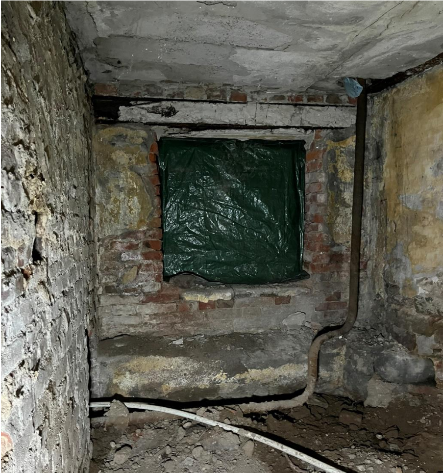
Фото 14. Пом. 1-Н, пом. 3.
