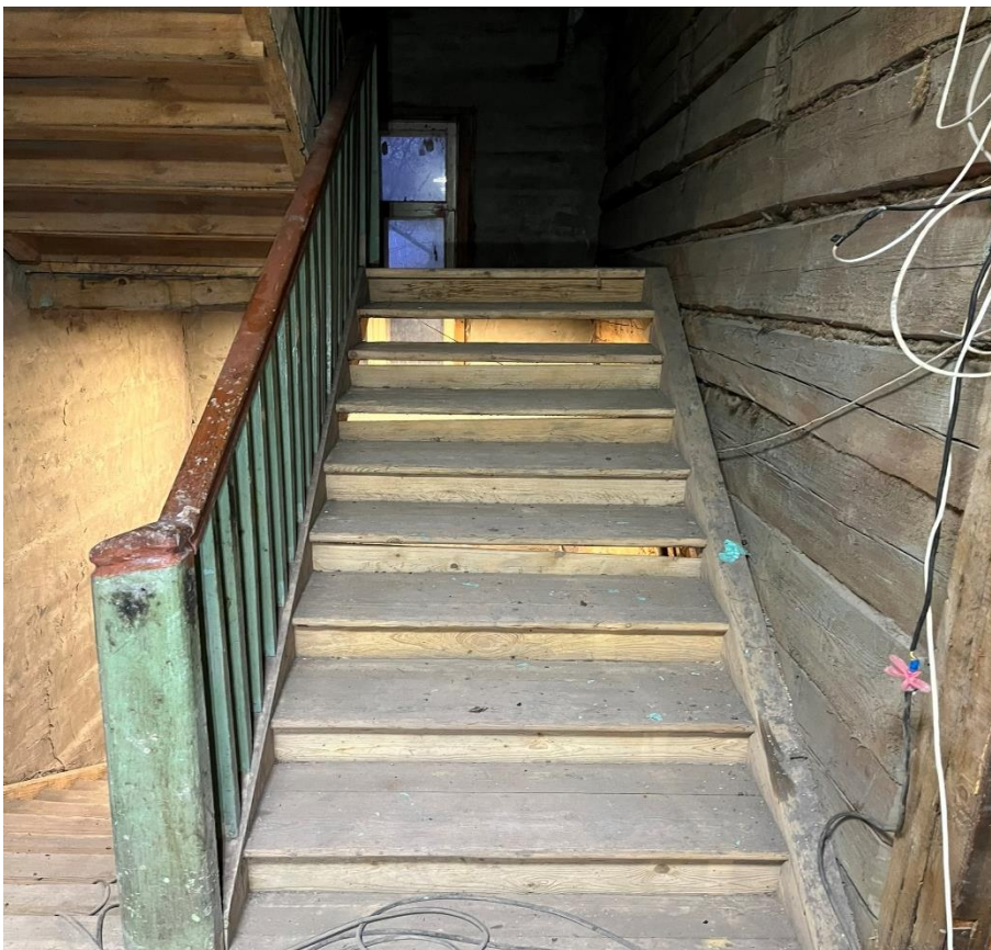
Фото 89. Промежуточная площадка 1ЛК между 2 этажом и чердаком.
