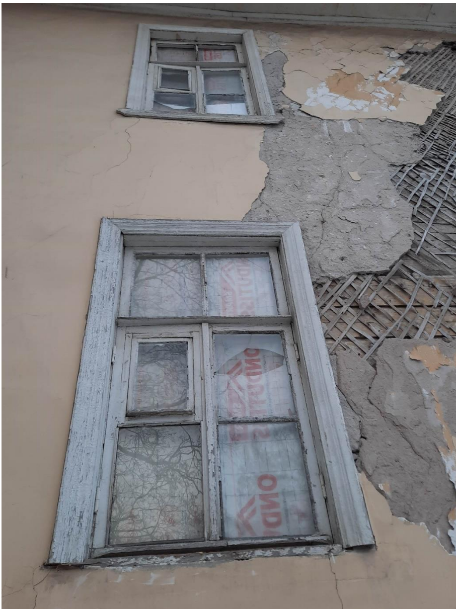
Фото 12. Оконное заполнение 1 и 2 этажей.
