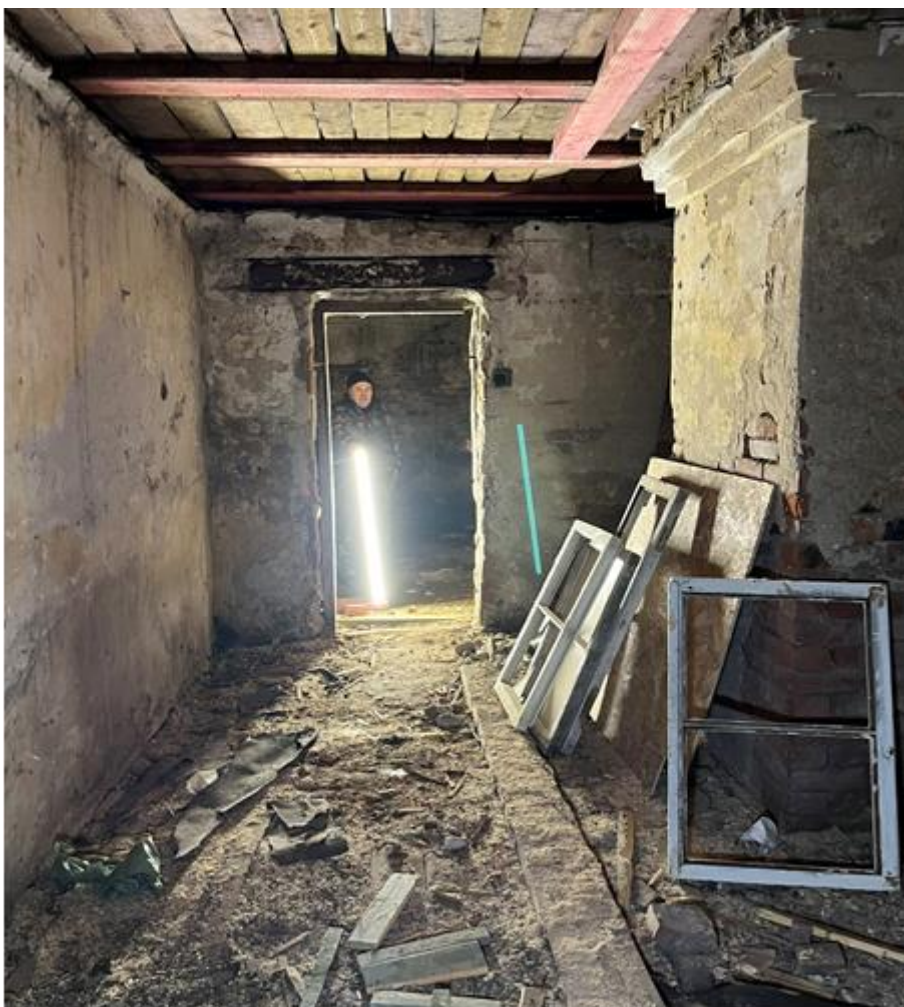
Фото 26. Пом. 2-Н, пом. 9.
