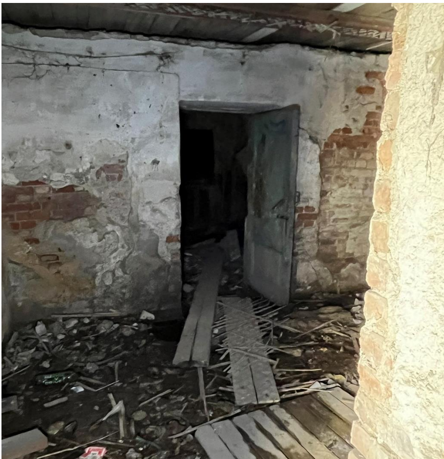
Фото 4. Пом. 3-Н, пом. 1.
