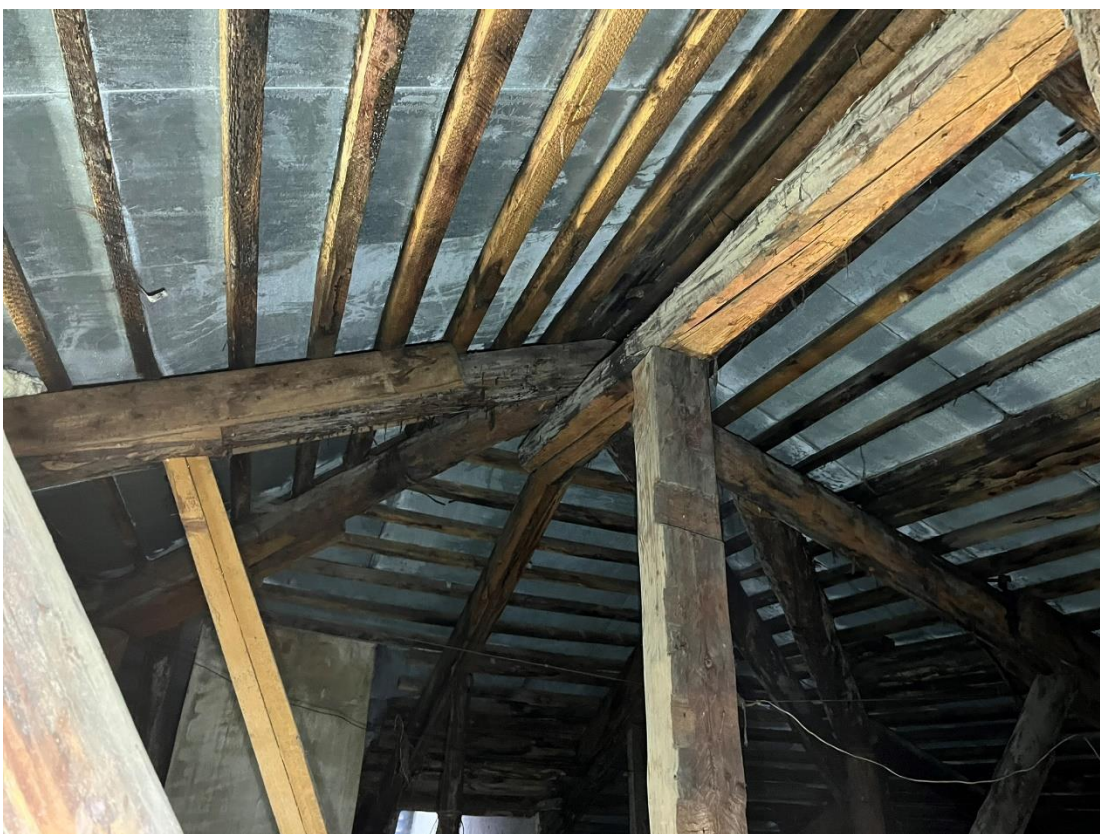
Фото 103. Стропильная система. Конек.
