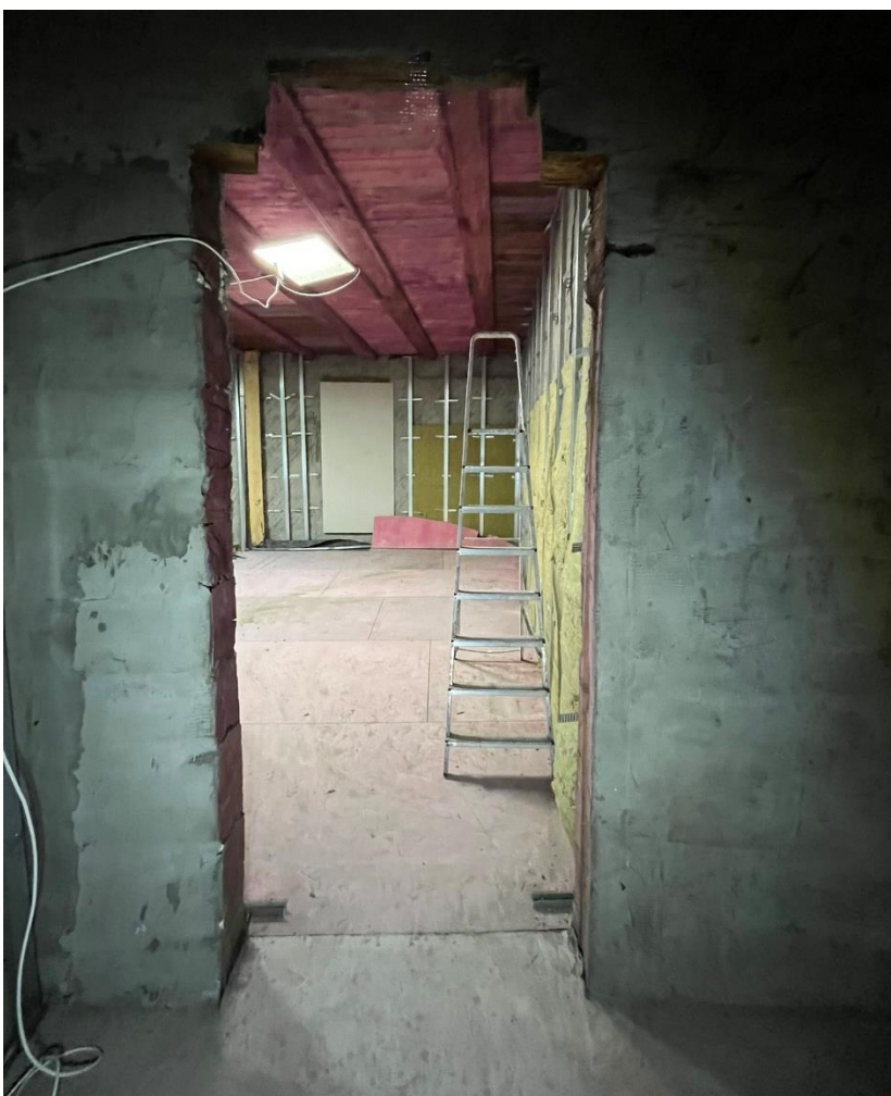
Фото 52. Кв. №5, вид из пом. 1.
