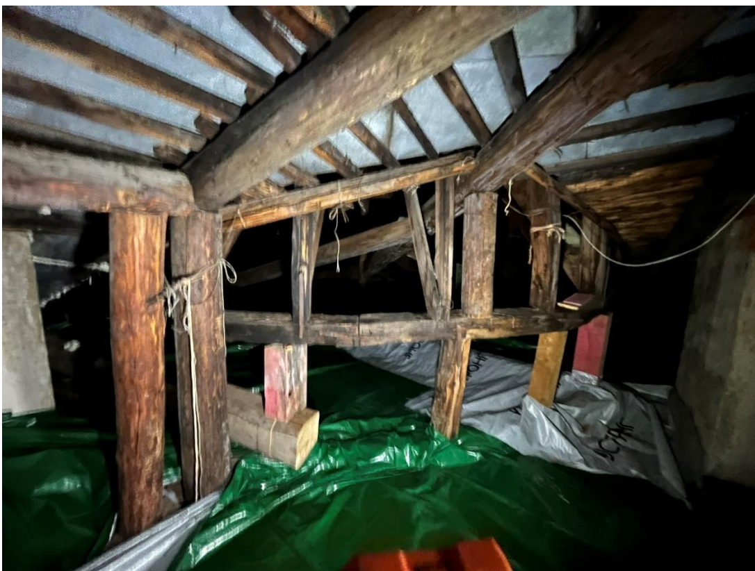
Фото 97. Помещение чердака. Вид на конструкции купола угловой башни.
