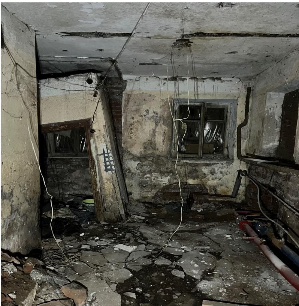
Фото 13. Пом. 1-Н, пом. 2.
