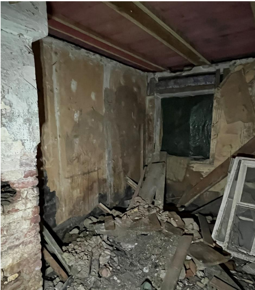
Фото 11. Пом. 3-Н, пом. 6.
