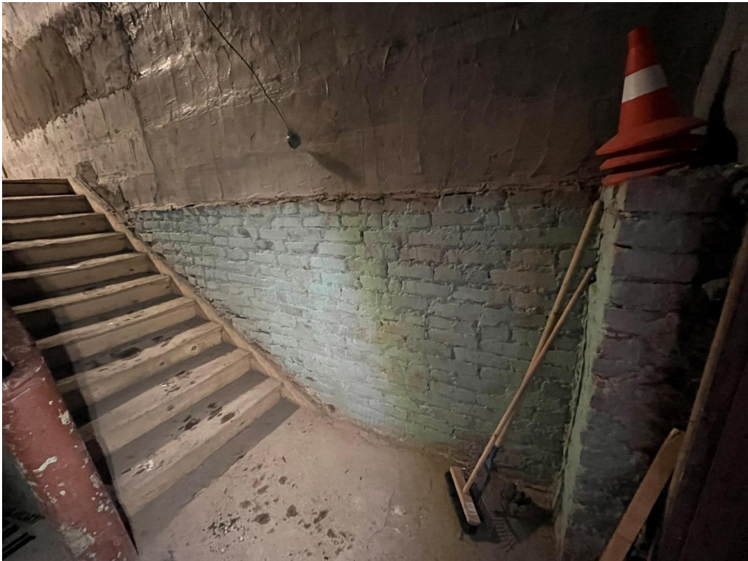
Фото 28. Лестничная площадка 1/К.
