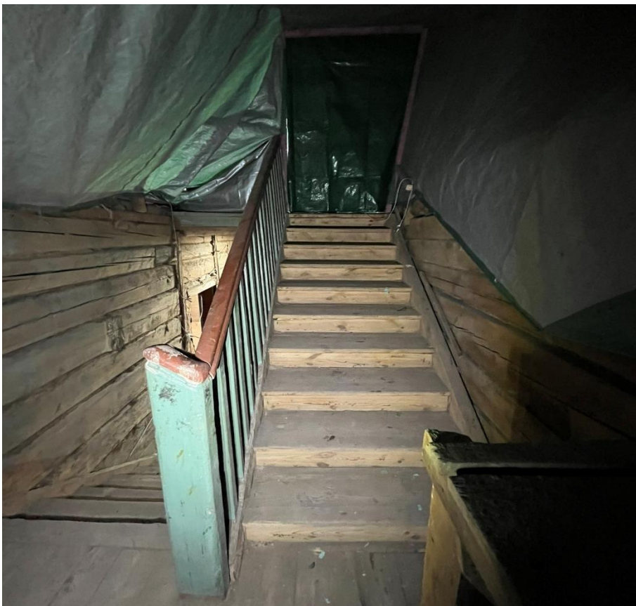
Фото 90. Лестничный марш на чердак.
