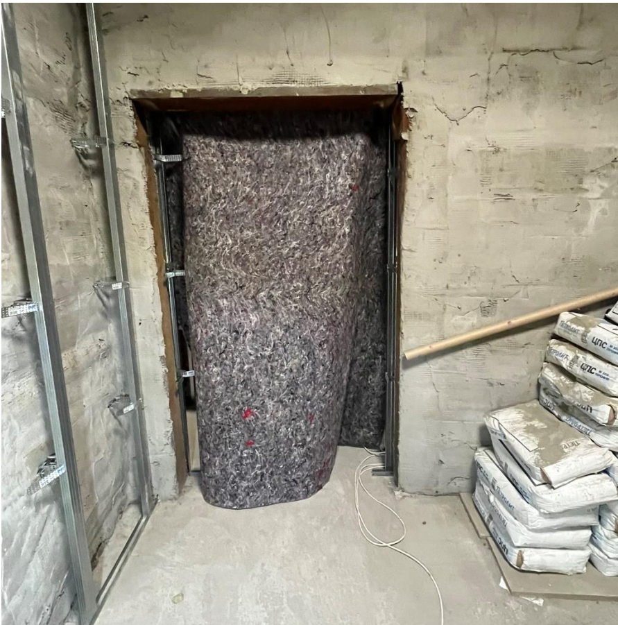
Фото 46. Кв. №4, пом. 1. Вид на пом. 5.
