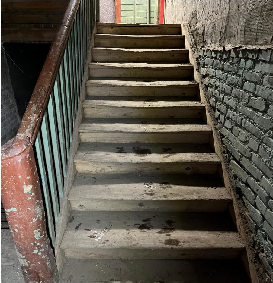
Фото 29. Марш лестничной клетки 1ЛК.
