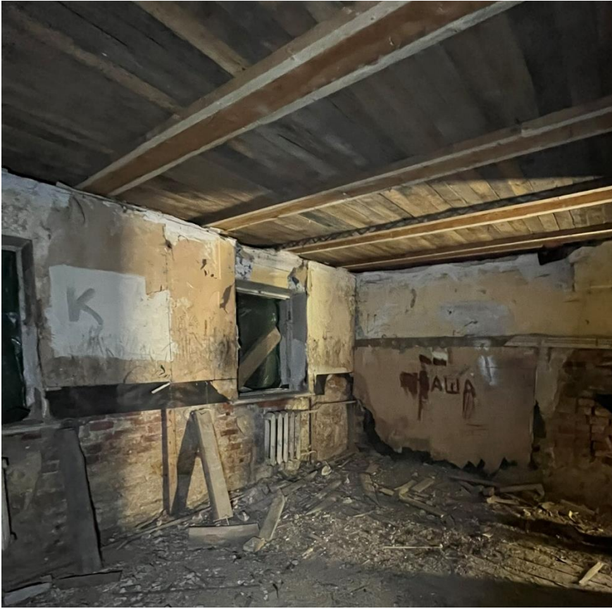
Фото 10. Пом. 3-Н, пом. 5.
