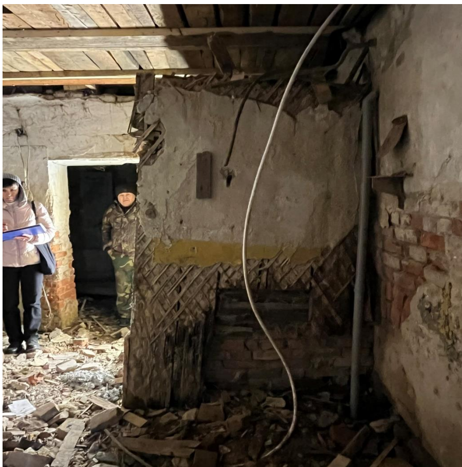
Фото 8. Пом. 3-Н, пом. 4.
