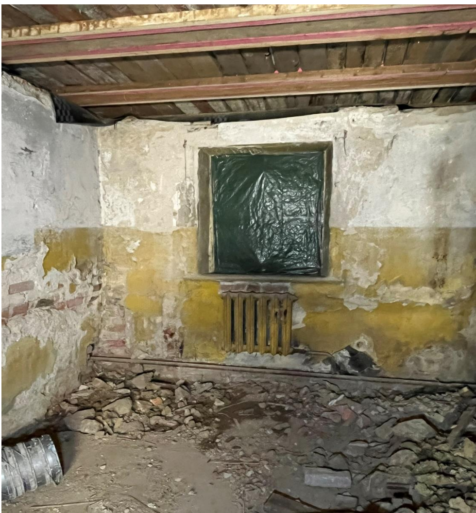
Фото 7. Пом. 3-Н, пом. 4.
