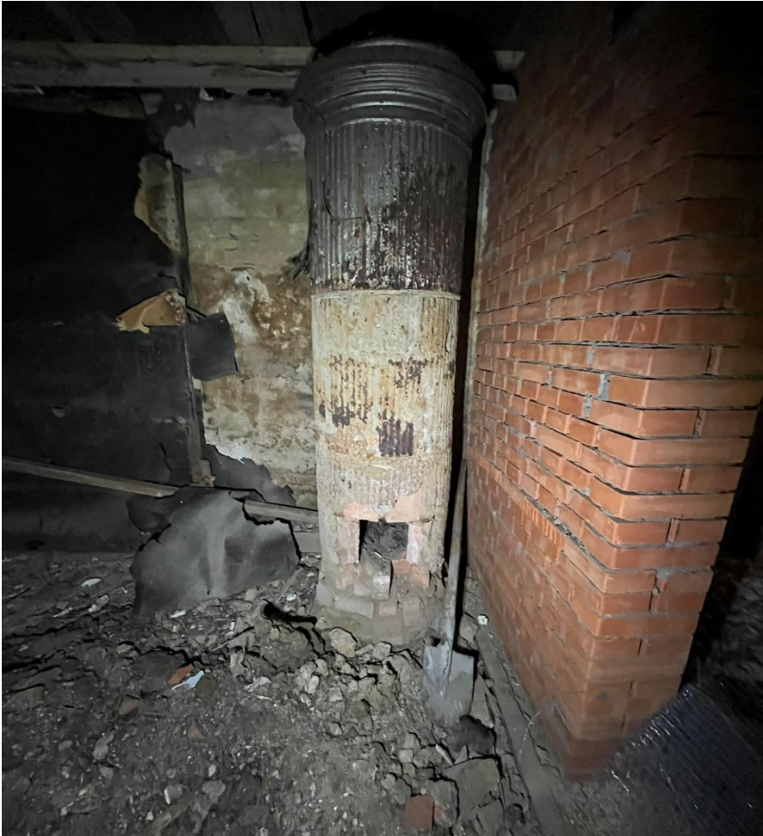
Фото 24. Пом. 2-Н, пом. 8.
