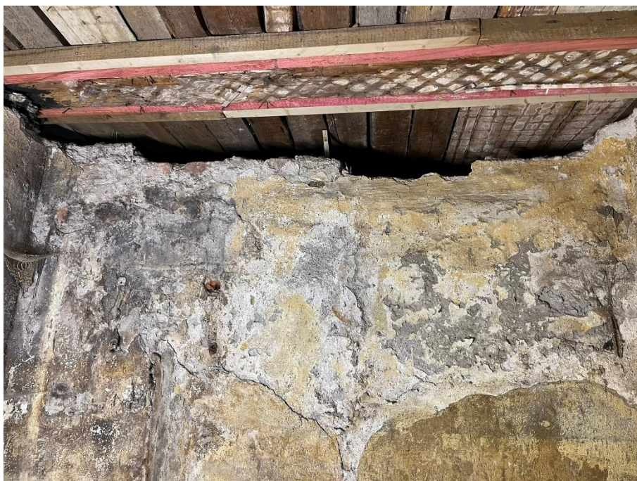
Фото 27. Пом. 2-Н, пом. 1.
