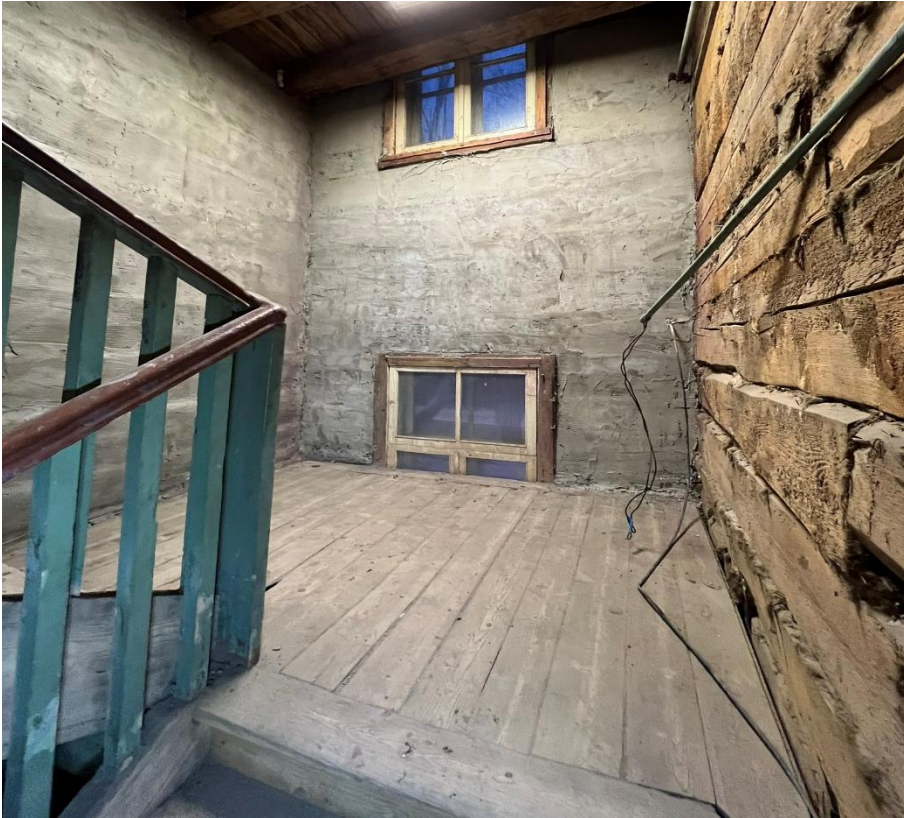
Фото 57. Промежуточная площадка 1ЛК между 1 и 2 этажами.
