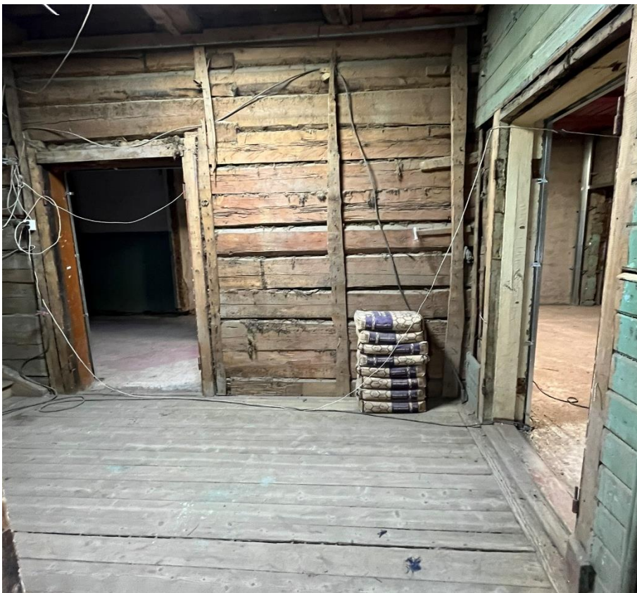
Фото 88. Кв. №8, вид из пом. 1 на лестничную площадку 1ЛК.
