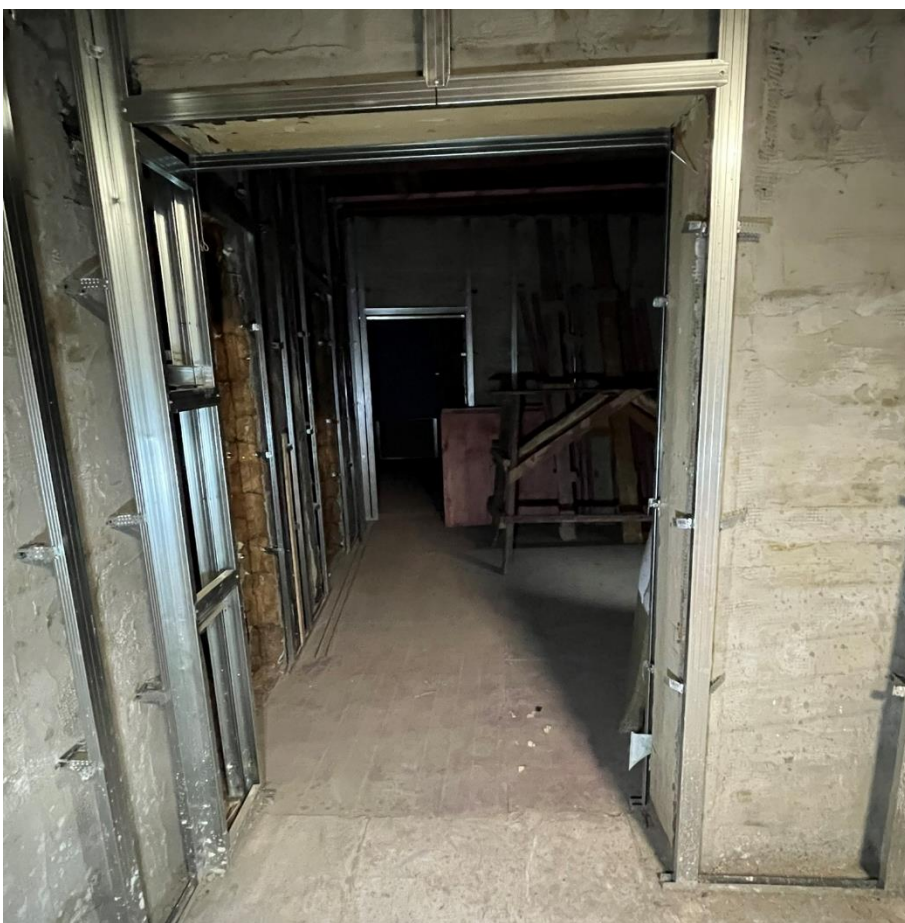
Фото 74. Кв. №7, вид из пом. 1.
