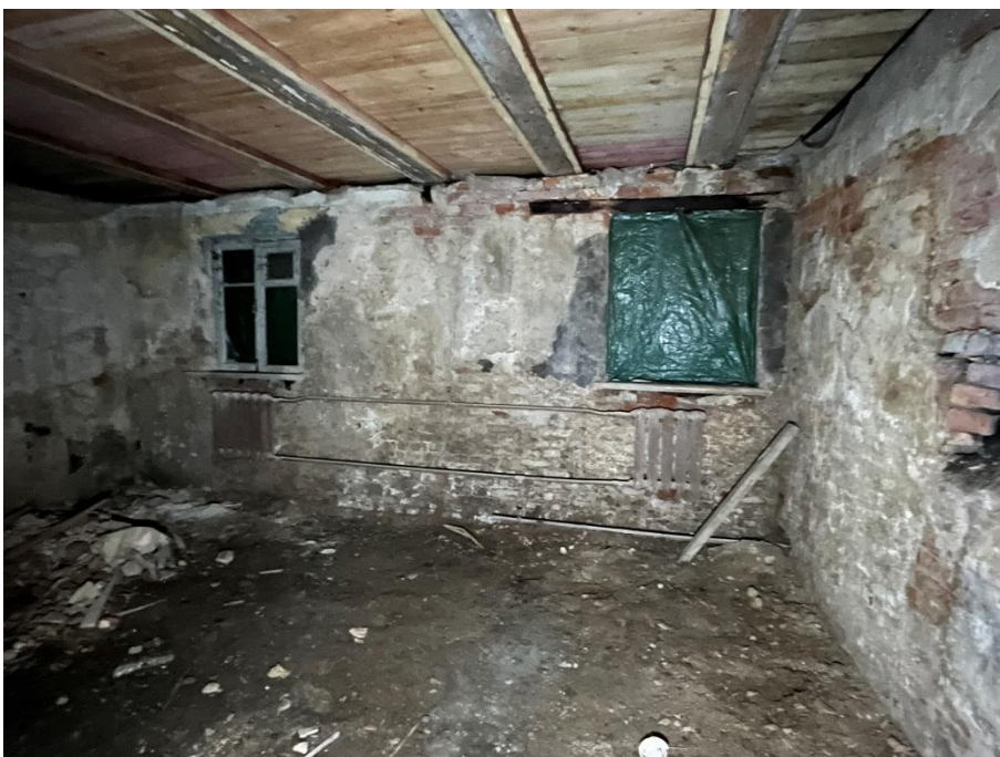
Фото 16. Пом. 2-Н, пом. 3.
