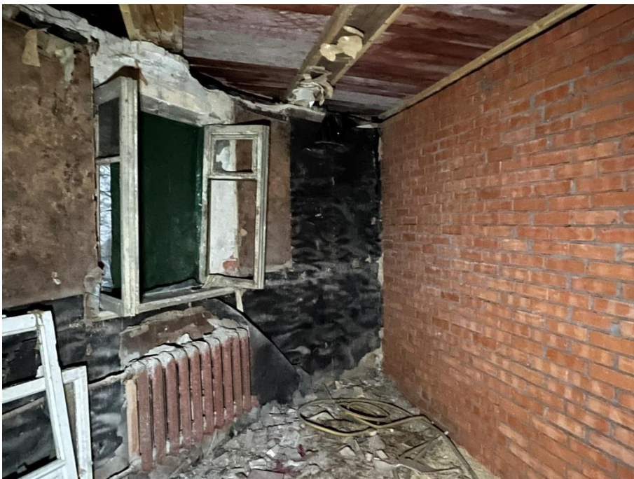
Фото 22. Пом. 2-Н, пом. 7.
