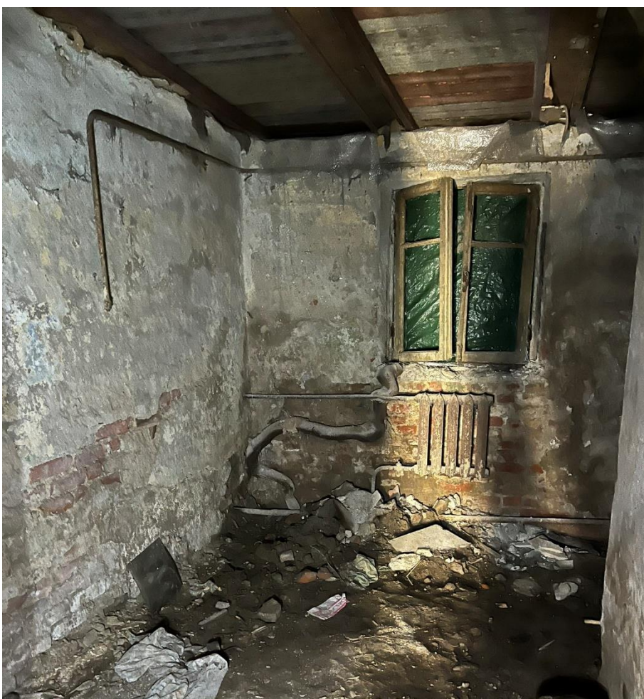
Фото 19. Пом. 2-Н, пом. 5.
