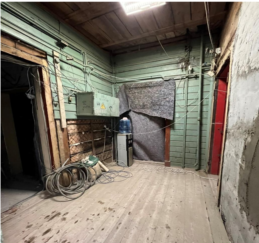
Фото 30. Лестничная площадка 1 этажа 1ЛК.
