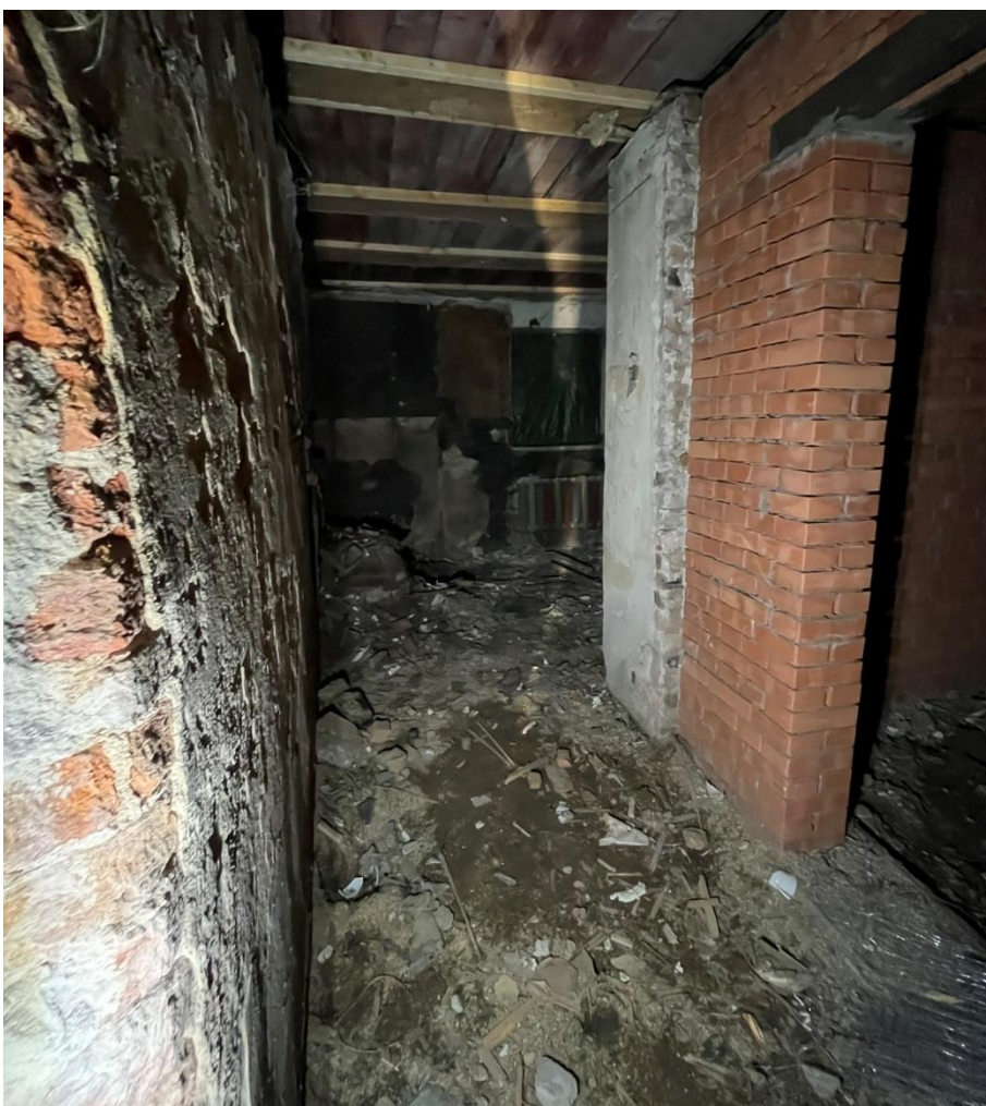
Фото 21. Пом. 2-Н, пом. 6.
