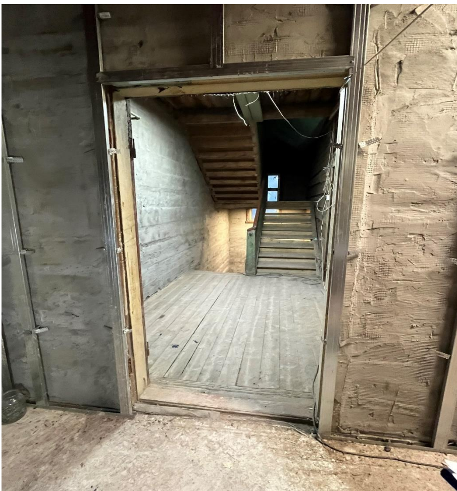
Фото 75. Кв. №7, вид из пом. 1.
