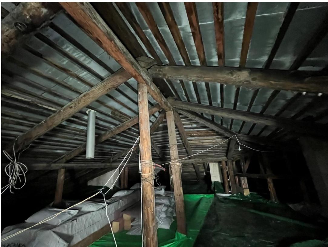
Фото 104. Стропильная система. Конек.
