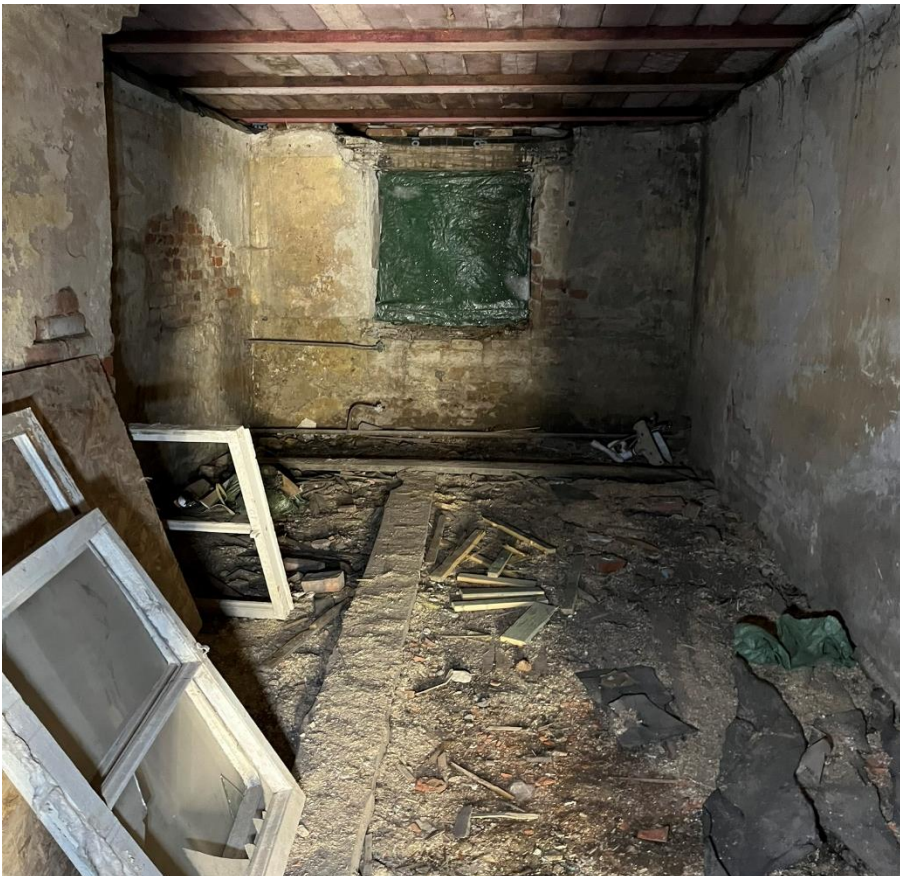
Фото 25. Пом. 2-Н, пом. 9.
