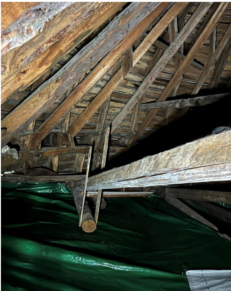
Фото 98. Конструкции купола угловой башни. Левая часть.
