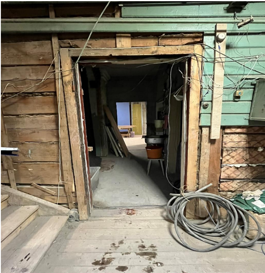
Фото 33. Лестничная площадка 1 этажа 1ЛК. Входная дверь в квартиру №3.
