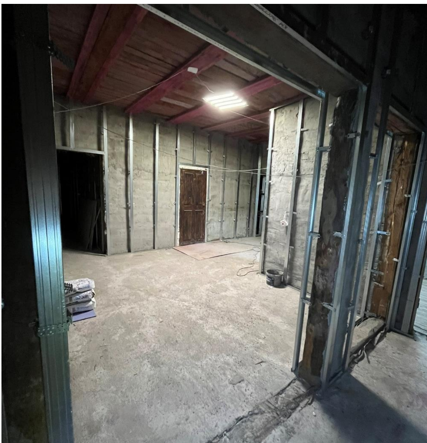
Фото 67. Кв. №6, вид из пом. 1.
