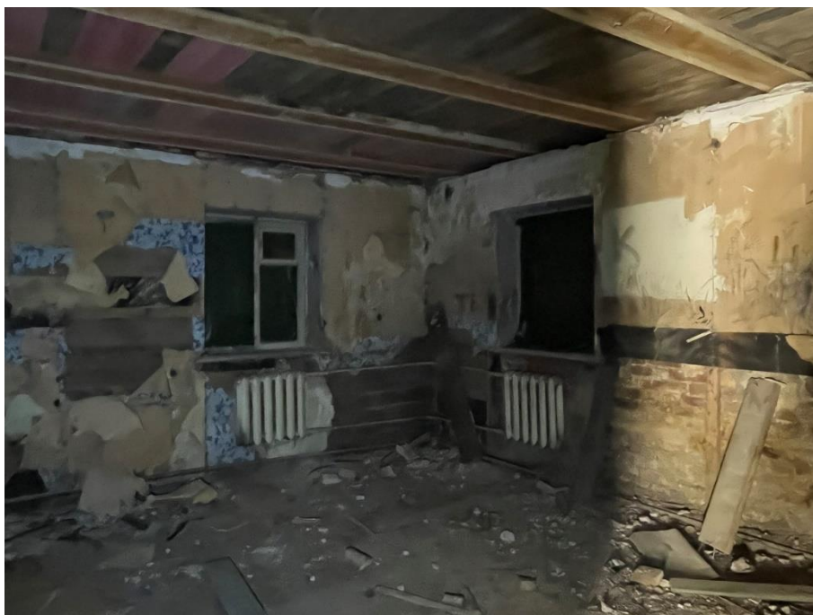
Фото 9. Пом. 3-Н, пом. 5
