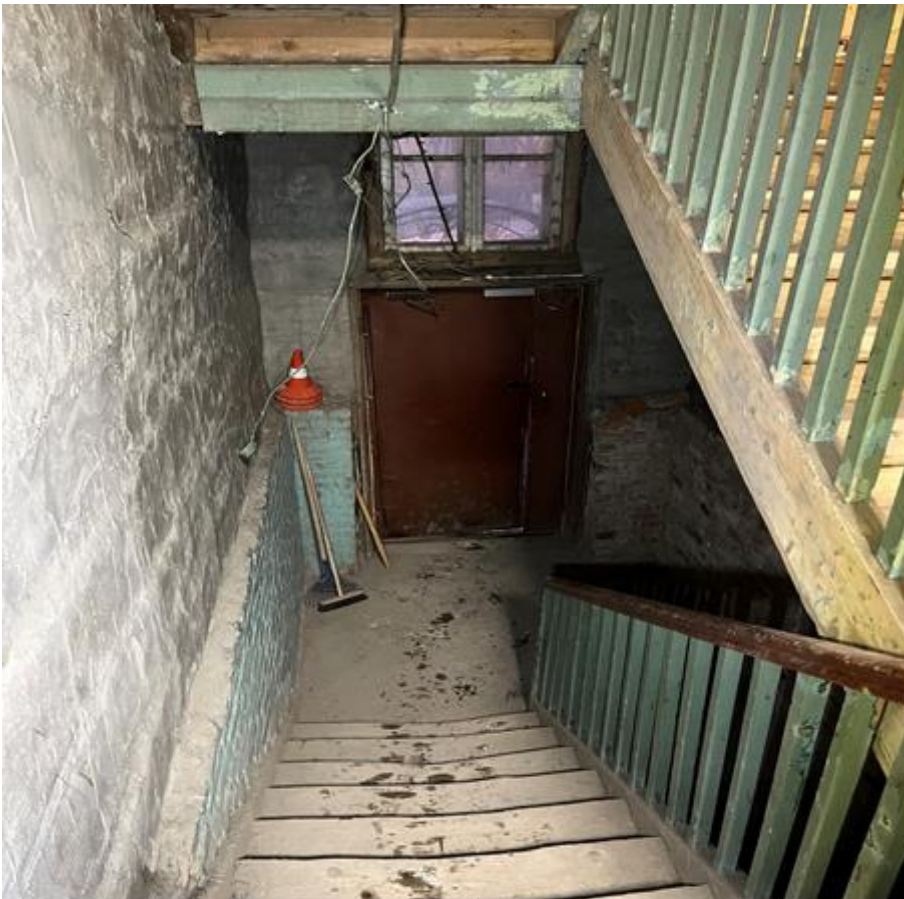
Фото 32. Лестничная площадка 1ЛК между цокольным и 1 этажом. Входная дверь в здание.
