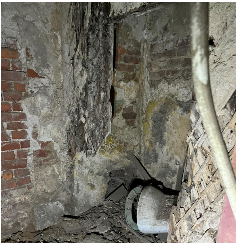
Фото 5. Пом. 3-Н, пом. 7.
