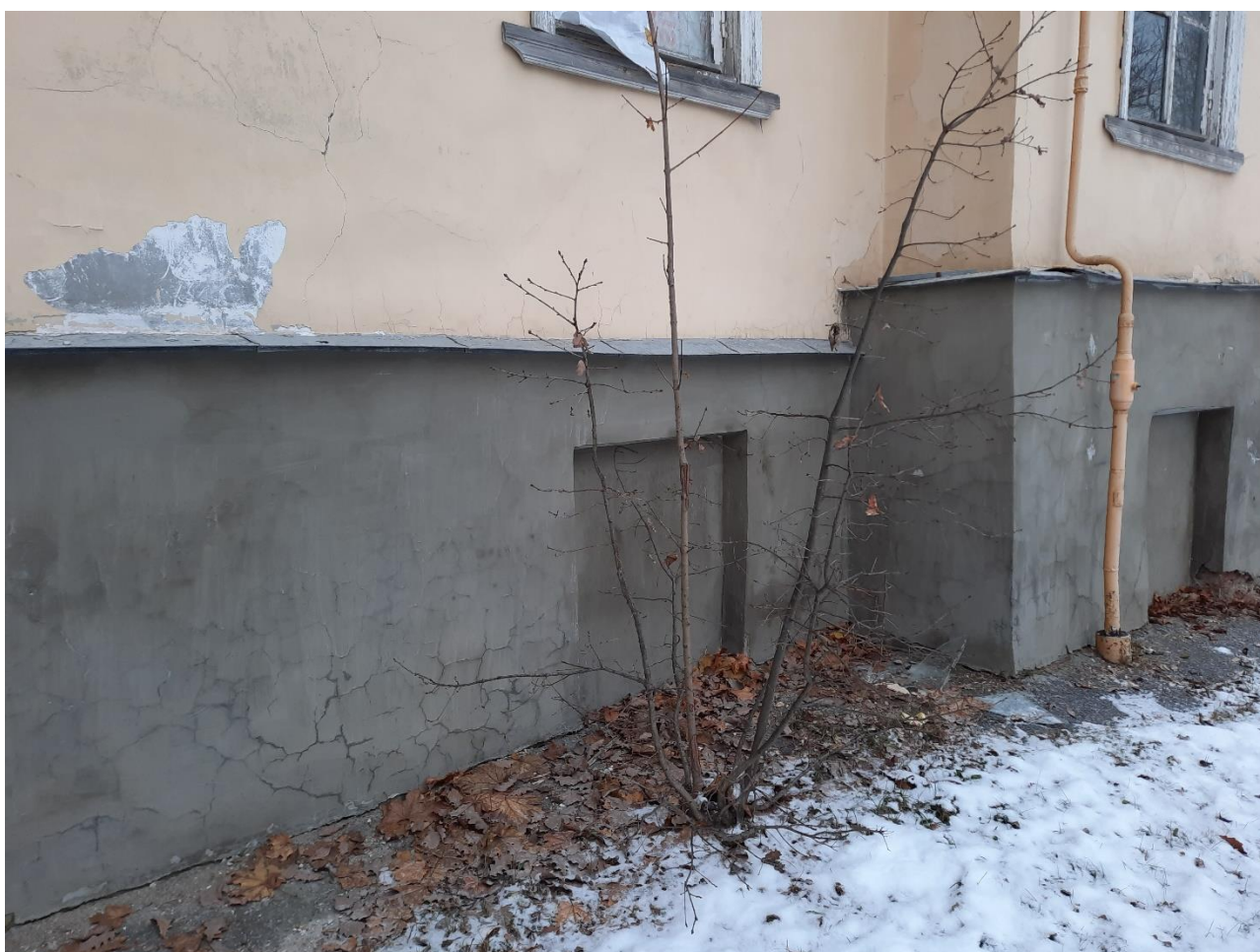
Фото 10. Цоколь со стороны заднего фасада.
