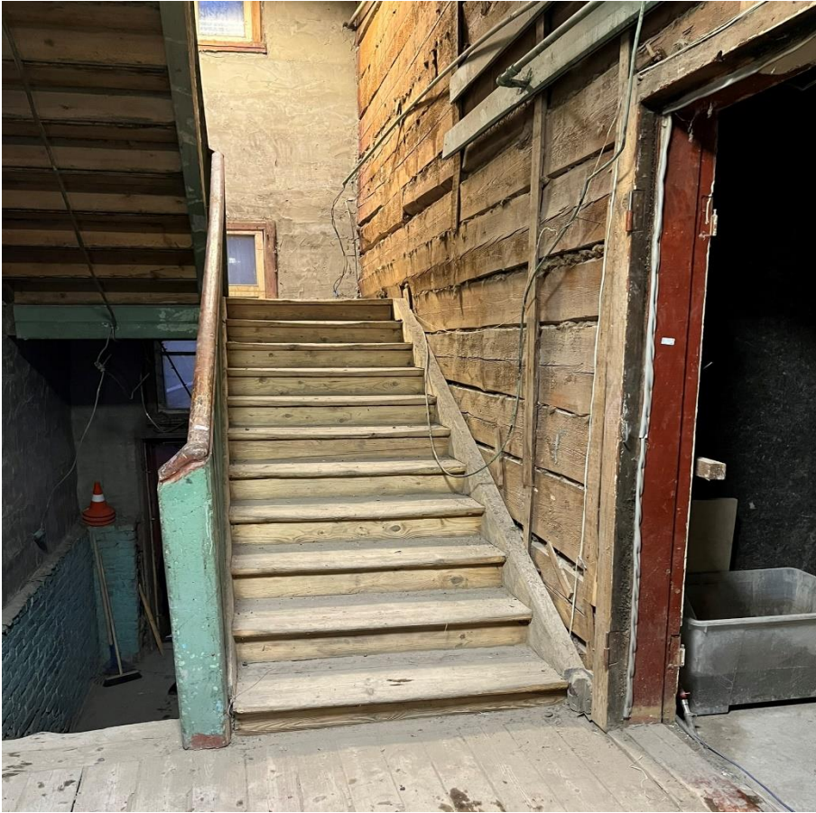
Фото 31. Лестничная площадка 1 этажа 1ЛК. Вид на промежуточный марш.
