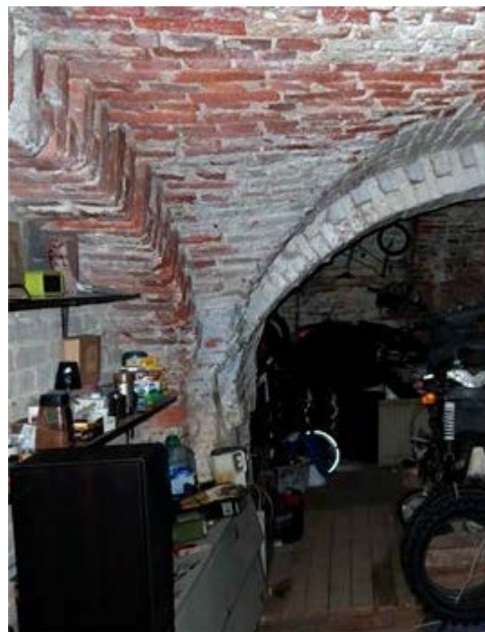
Фото 18. Подвальное помещение 20-Н (7) восточного корпуса. Кирпичные крестовые своды.
