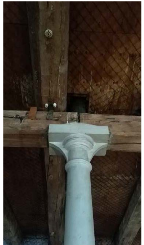
Фото 22. Помещение 34-Н (4) западного корпуса. Металлическая историческая колонна.
