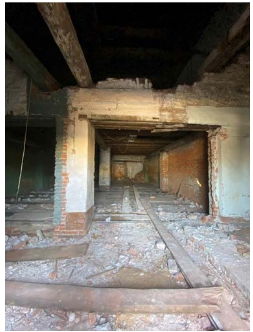
Фото 24. Помещение 23-Н (8) восточного корпуса.
