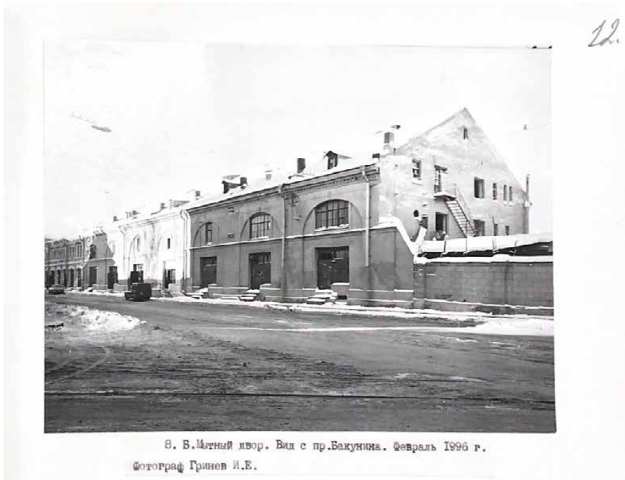
Илл. 44. Вид брандмауэра и части лицевого фасада бывшего Мытного двора со стороны перекрестка пр. Бакунина и Евгеньевской ул. Фотограф: И. Е. Гринев. Февраль 1996 г. ЦГАНТД СПб. Ф. Р-488. Оп. 323. Д. 600. Л. 12.
