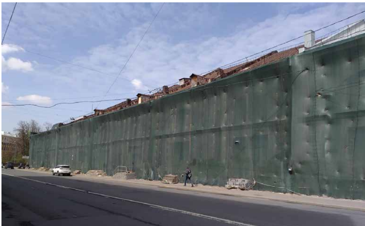
Фото 2. Общий вид лицевых фасадов западного и восточного корпусов со стороны пр. Бакунина. В настоящее время, на основании разрешения КГИОП от 17.01.2023 № 01-26-2697/22-0-1, на лицевые фасады со стороны пр. Бакунина установлена защитная сетка.
