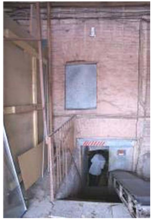
Фото 20. Междуэтажное перекрытие 2-го этажа западного корпуса.
