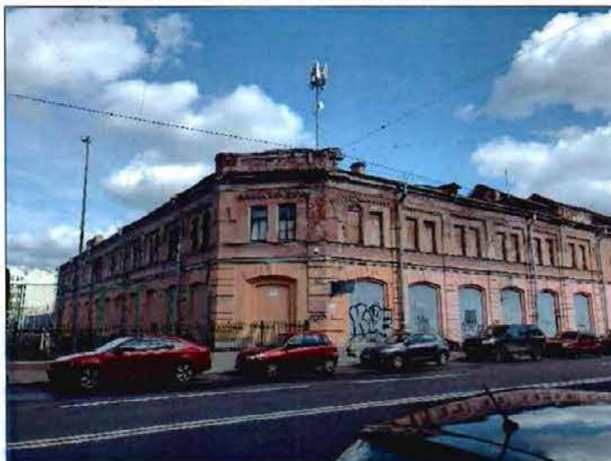
2. Вид на объект культурного наследия с юго-западной стороны
