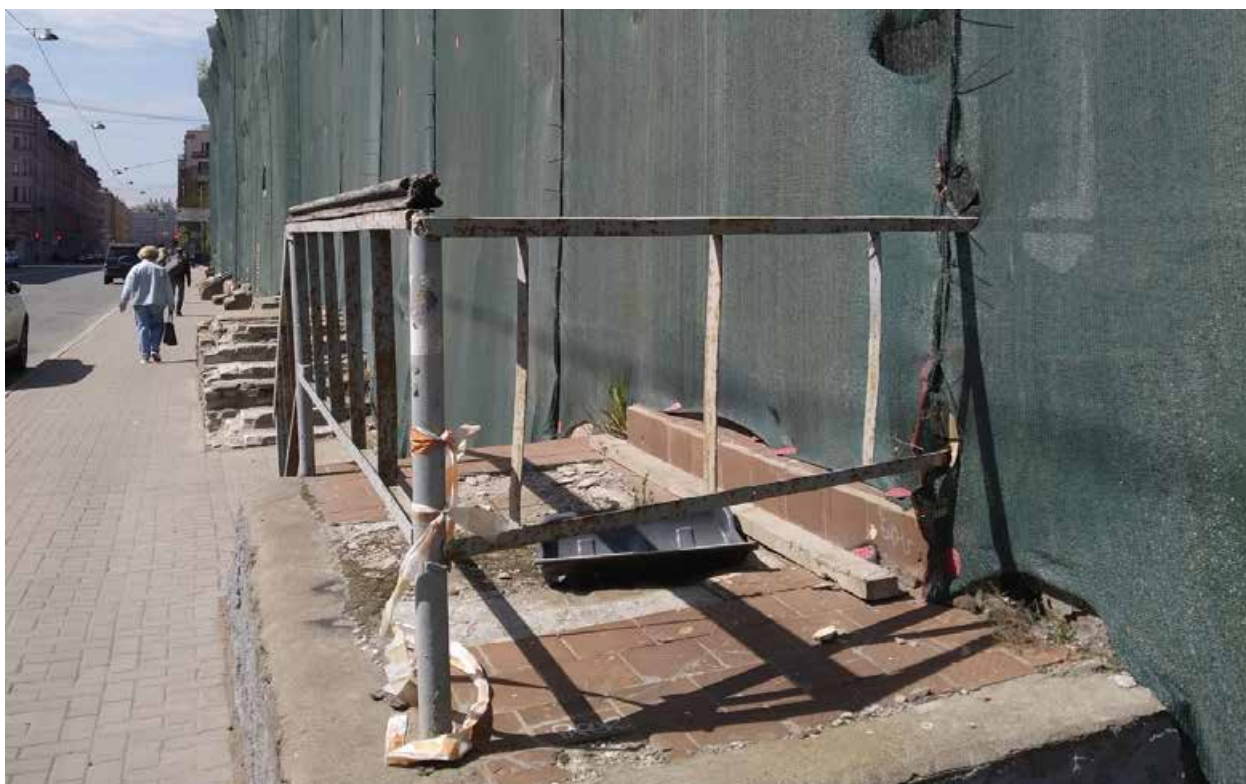
Фото 4. Фрагмент лицевого фасада восточного корпуса со стороны пр. Бакунина. Поздние крыльца. Подлежат восстановлению в исторической конфигурации и материале – известняк.
