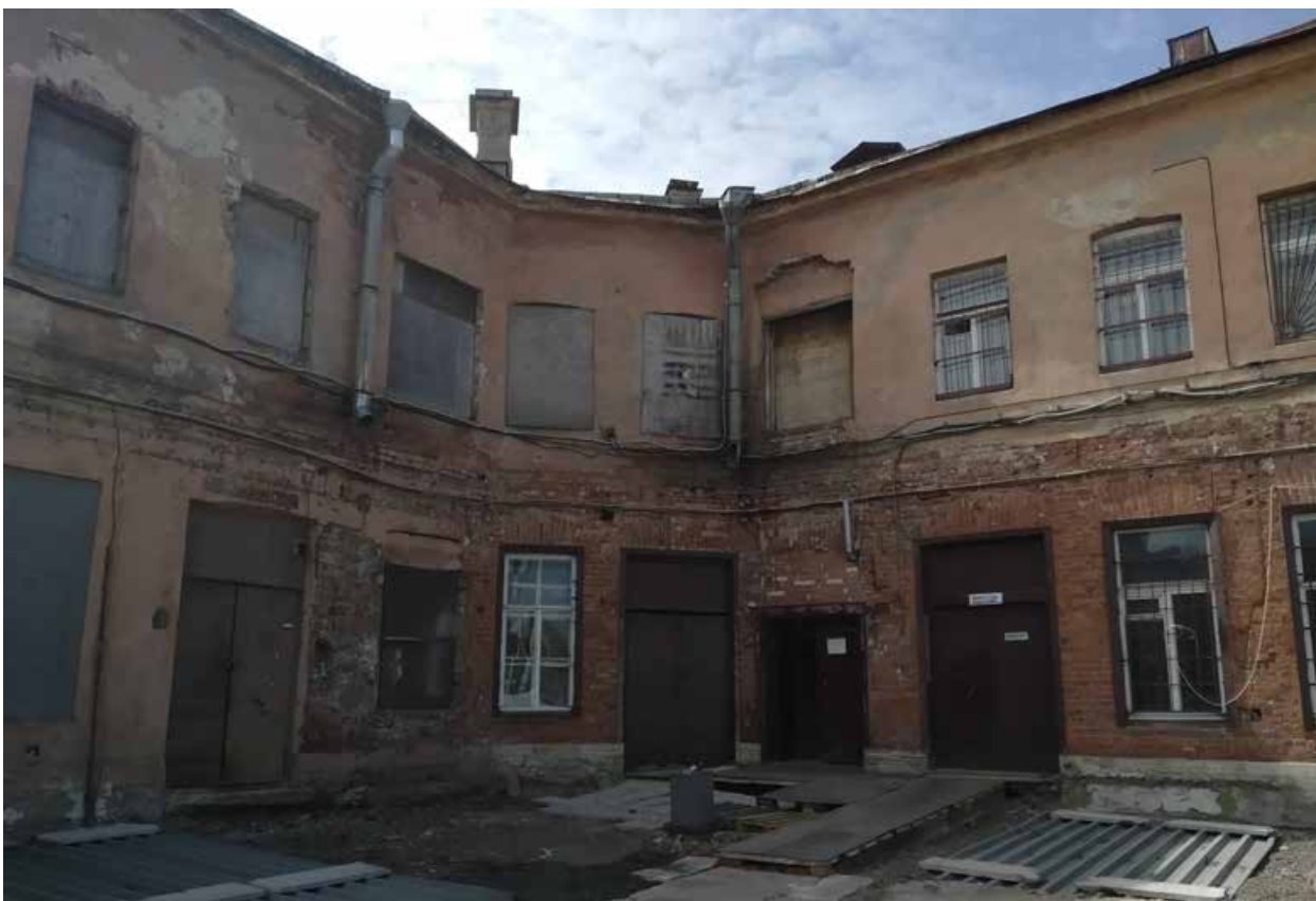
Фото 12. Фрагмент дворового фасада западного корпуса. Угловая часть. Поздние навесы и платформы демонтированы в соответствии с согласованной документацией.
