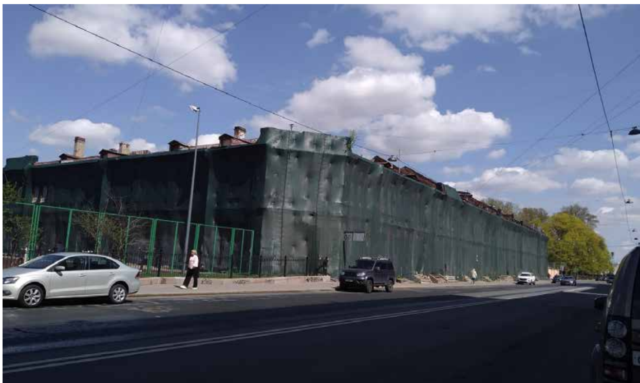
Фото 1. Общий вид здания объекта культурного наследия со стороны пр. Бакунина. В настоящее время, на основании разрешения КГИОП от 17.01.2023 № 01-26-2697/22-0-1, на лицевые фасады со стороны пр. Бакунина и Овсянниковского сквера установлена защитная сетка.
