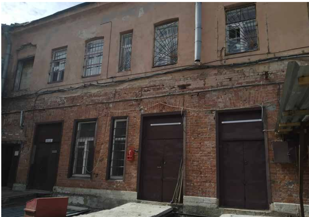
Фото 14. Фрагмент дворового фасада западного корпуса. После демонтажа поздних платформ раскрыт исторический цоколь из известняка.
