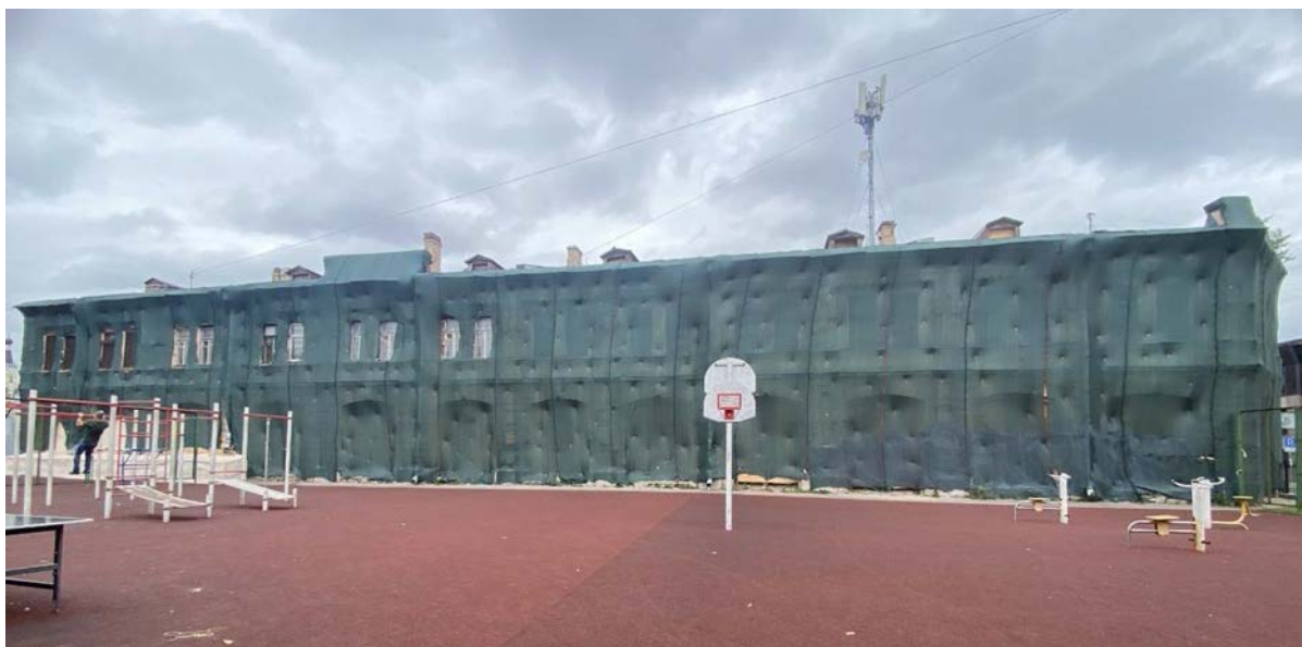
Фото 5. Лицевой фасад западного корпуса со стороны Овсянниковского сквера. В настоящее время, на основании разрешения КГИОП от 17.01.2023 № 01-26-2697/22-0-1, на лицевой фасад со Овсянниковского сквера установлена защитная сетка.
