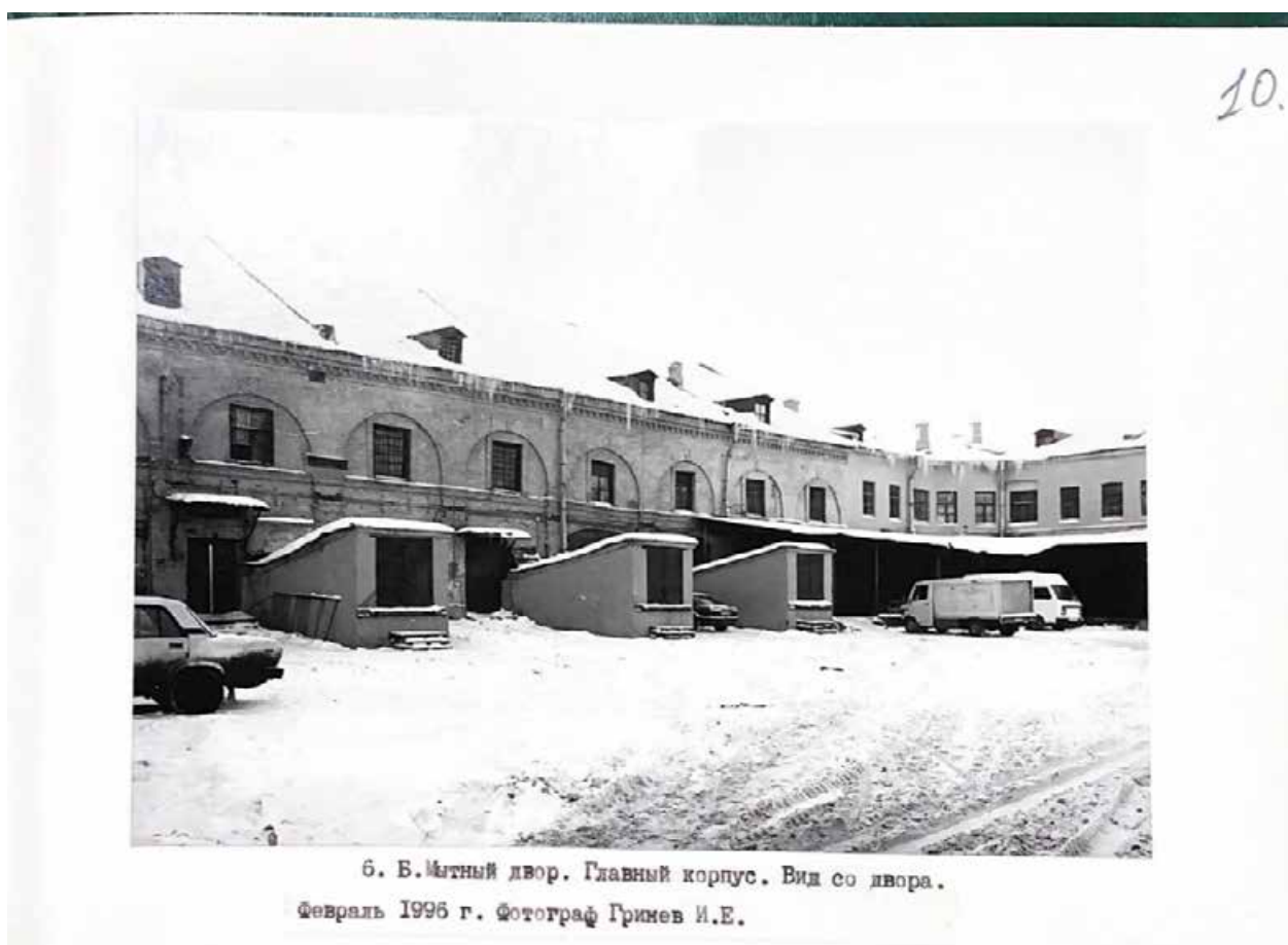
Илл. 42. Фрагмент дворового фасада бывшего Мытного двора. Фотограф: И. Е. Гринев. Февраль 1996 г. ЦГАНТД СПб. Ф. Р-488. Оп. 323. Д. 600. Л. 10.
