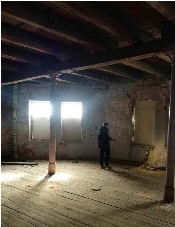
Фото 21. Помещение 34-Н (4) западного корпуса. Металлические исторические колонны.
