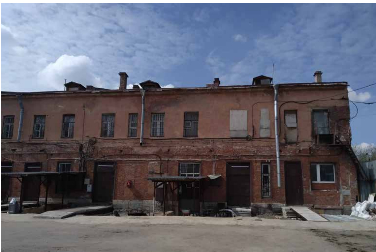
Фото 13. Фрагмент дворового фасада западного корпуса. Поздние навесы и платформы демонтированы в соответствии с согласованной документацией.
