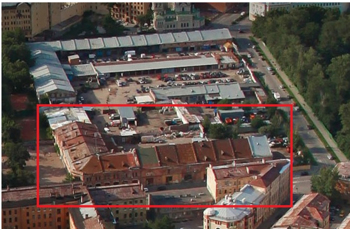
Илл. 48. Фотография (панорама) территории бывшего Мытного двора с воздуха. Исследуемое здание (ул. Евгеньевская, д. 2, лит. А) выделено красной рамкой. 2011 г. «Яндекс».
