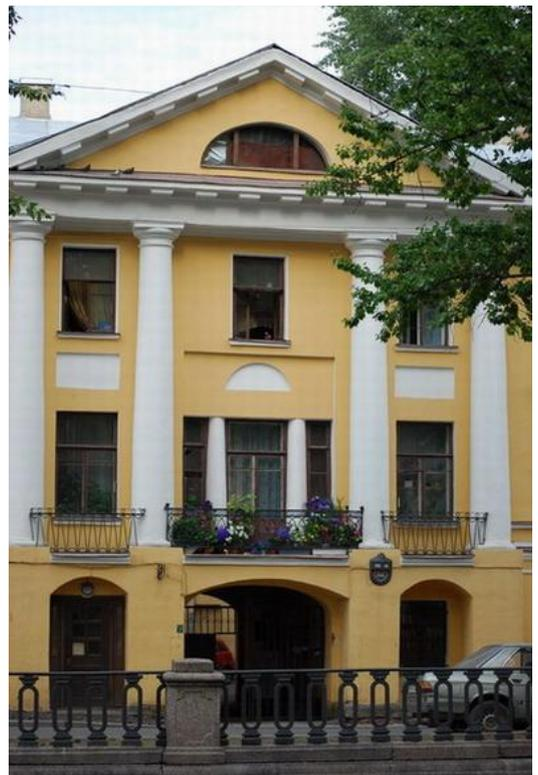
фронтон – количество (один), местоположение (венчающий портик, по оси воротного проезда), габариты, конфигурация (треугольный); оформление фронтона – венчающий карниз с модульонами;
