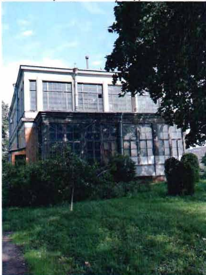
Фото 3. Вид на южный фасад объекта культурного наследия. (11.08.2023)
