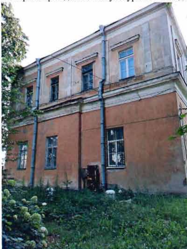
Фото 4. Вид на северный фасад объекта культурного наследия. (11.08.2023)
