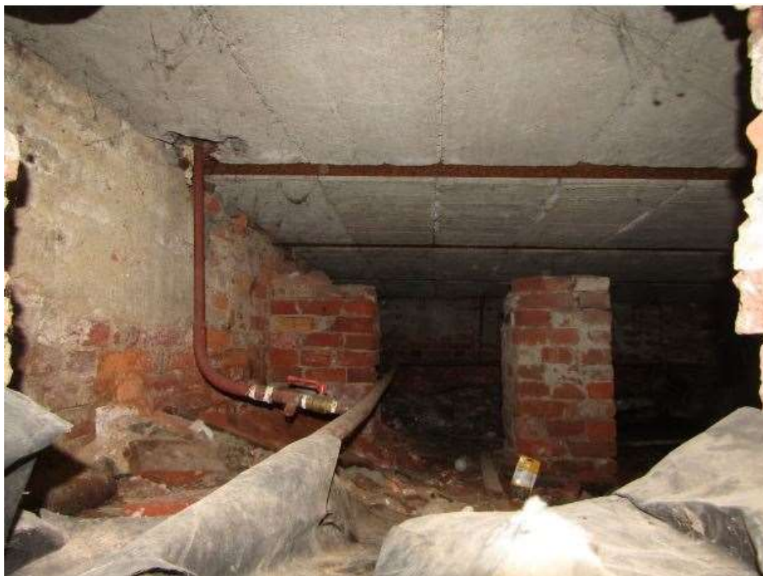
25. Объект культурного наследия федерального значения «Дом садовый» по адресу: Санкт-Петербург, улица Профессора Попова, дом 2, литера М Помещения цокольного этажа. Дата съемки: 09.04.2024
