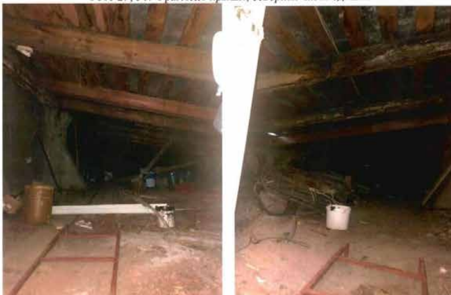
Фото 29, 30. Фрагмент крыши, северная часть здания.
