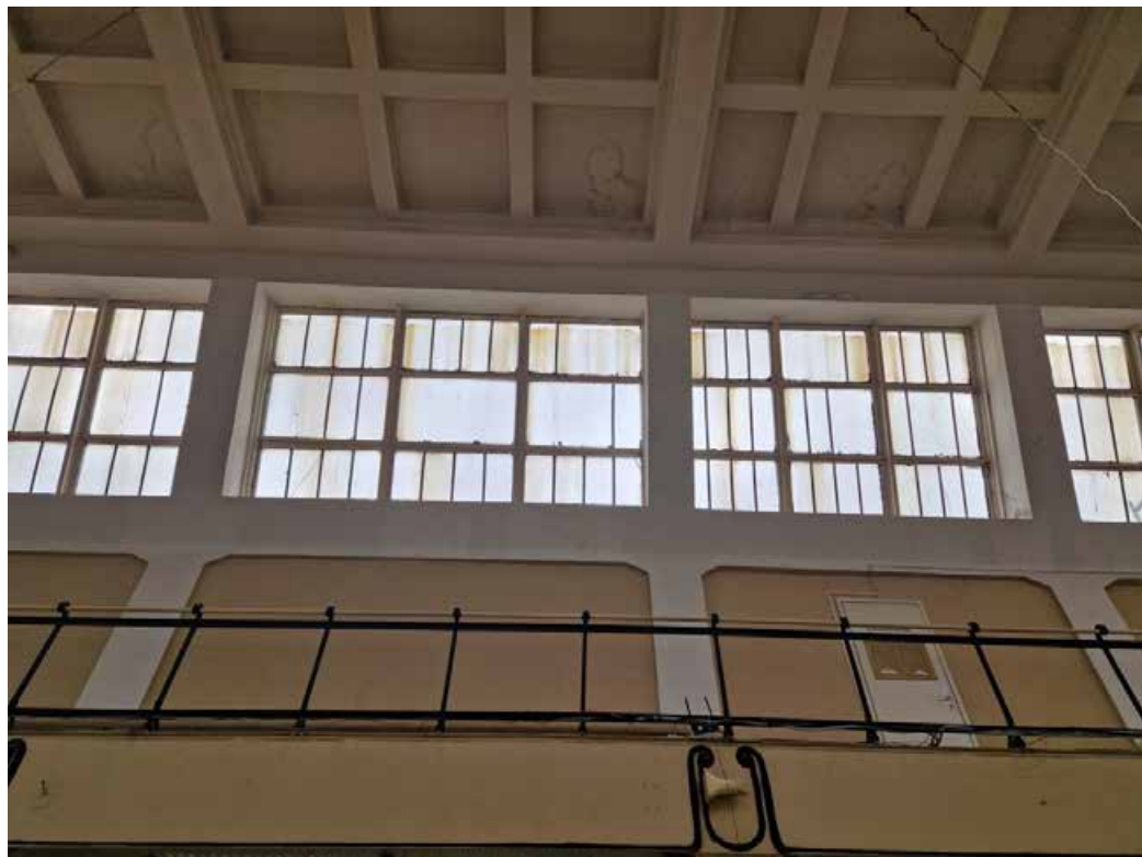
12. Объект культурного наследия регионального значения «Здание Сытного рынка» по адресу: г. Санкт-Петербург, Сытнинская ул., д. 5, литера А. Световой фонарь. Вид из интерьера. Фрагмент.
