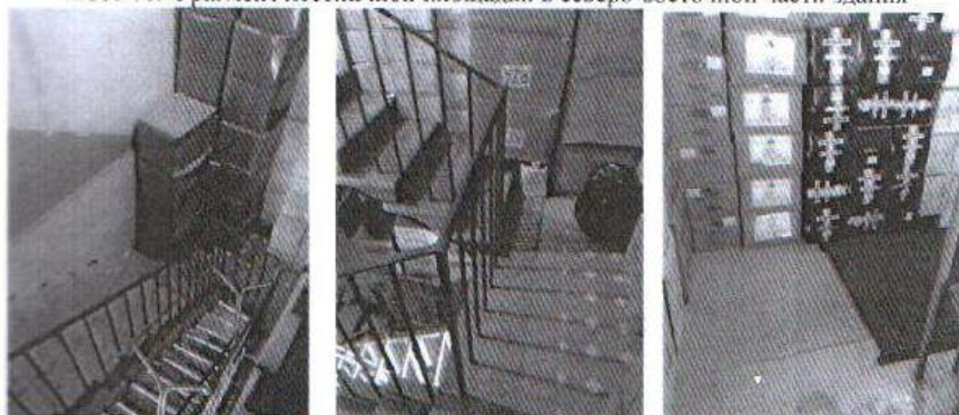
Фото 18. Фрагмент лестничной площадки в северо-восточной части здания
