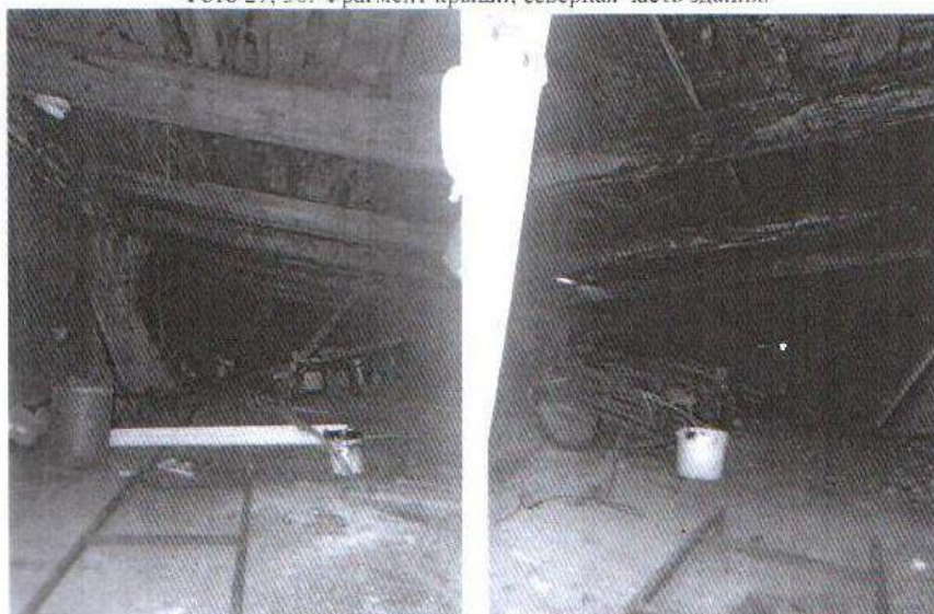
Фото 29, 30. Фрагмент крыши, северная часть здания.
