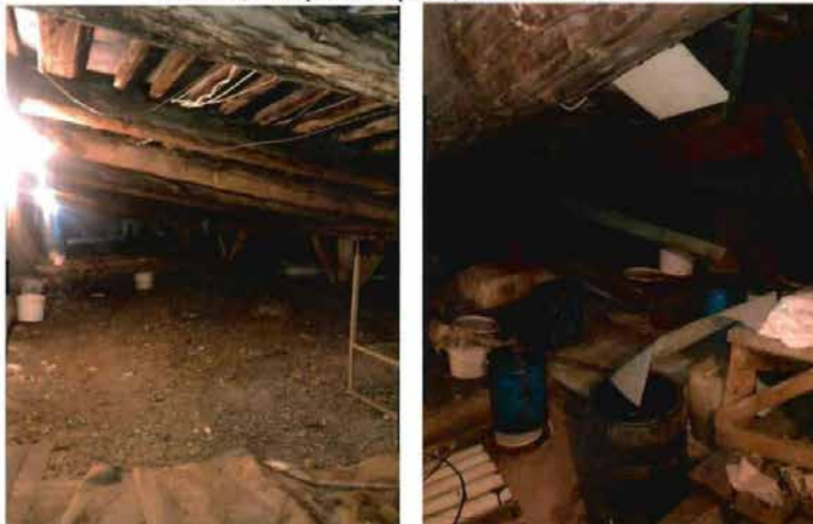
Фото 27, 28. Фрагмент крыши, южная часть здания.
