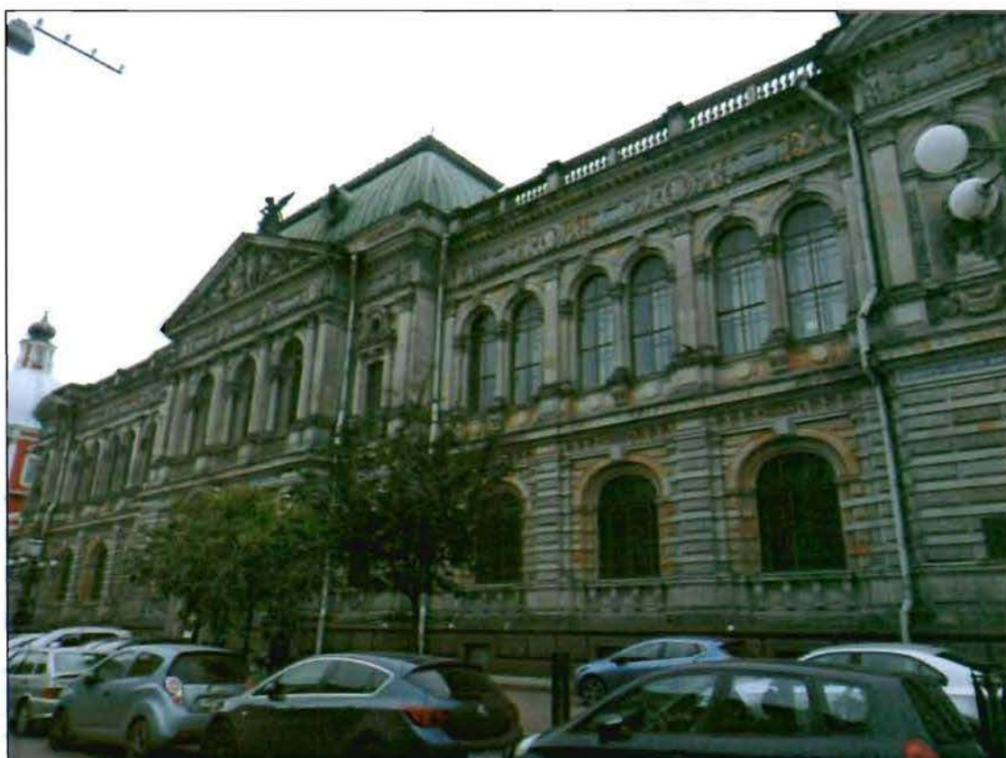
1. Общий вид с северо-востока.
