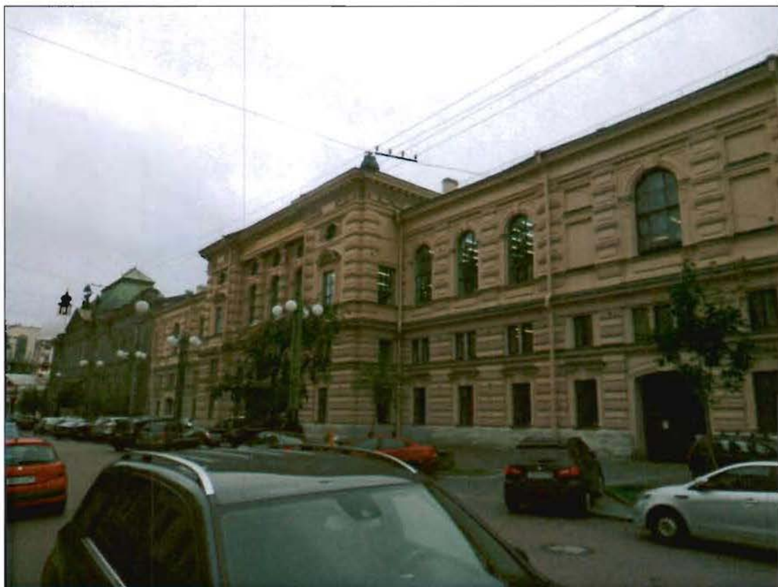
28. Лицевой фасад. Общий вид.
