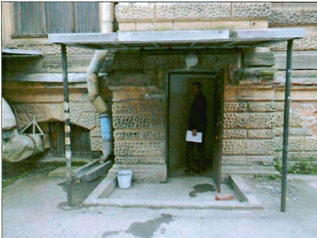
9. Северный дворовый фасад. Фрагмент.
