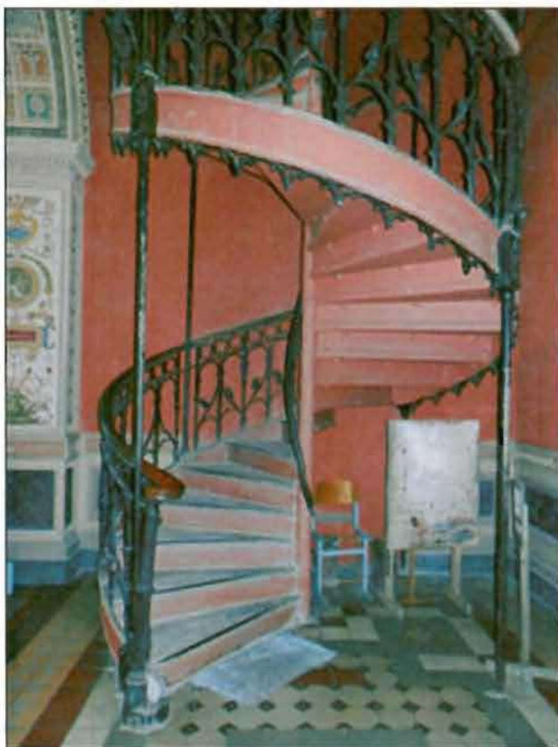
18. Помещение № 1-Н (285). Лестница.
