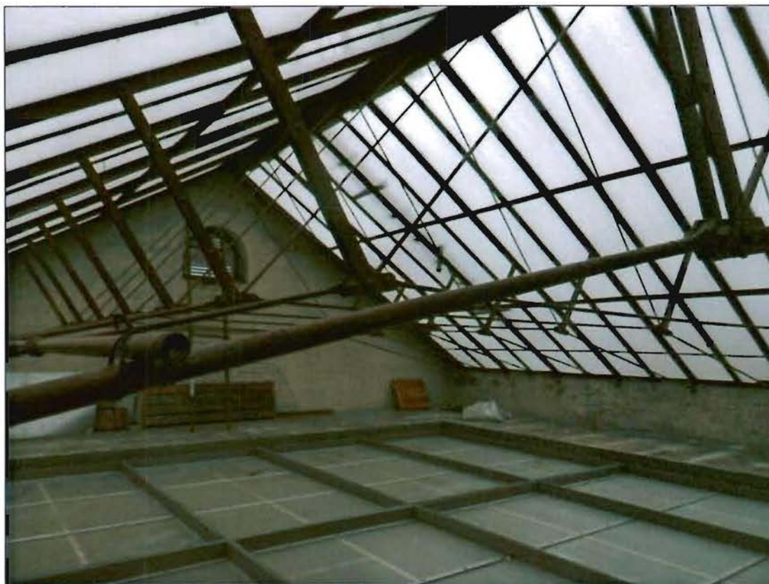
36. Металлические фермы над световым фонарем парадной лестницы.
