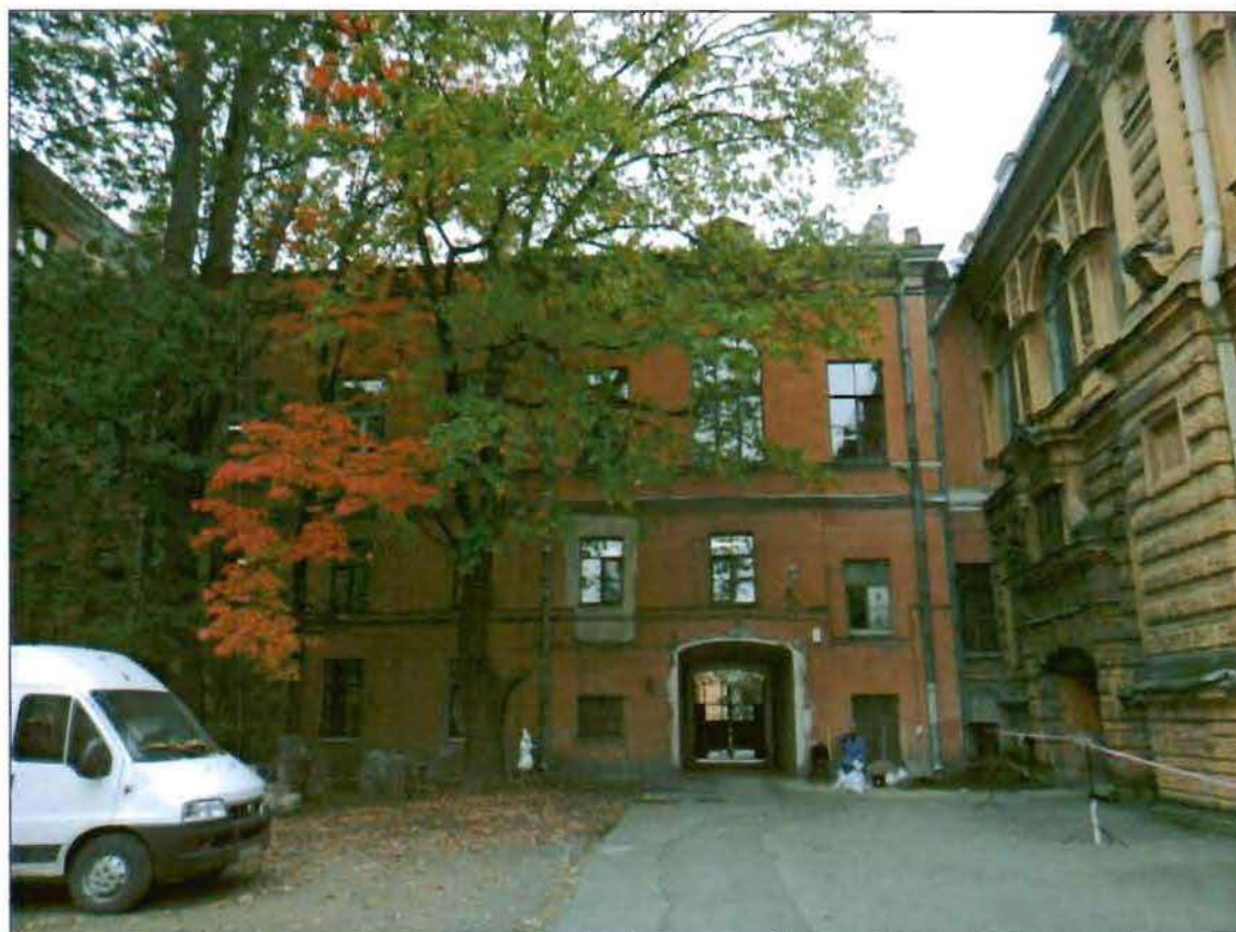
31. Восточный дворовый фасад. Общий вид.
