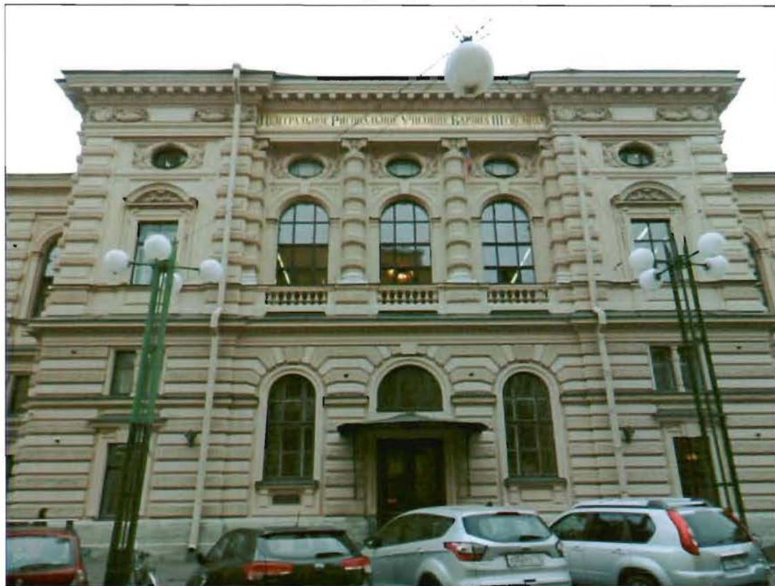
29. Лицевой фасад. Центральный ризалит.
