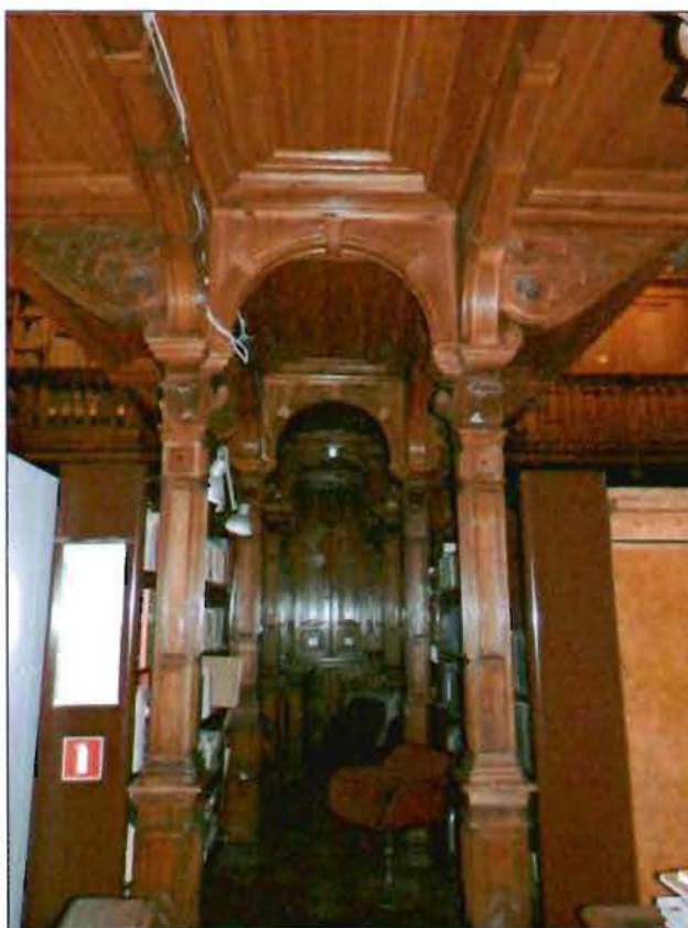
39. Помещение № 1-Н (271). Деревянные колонны.
