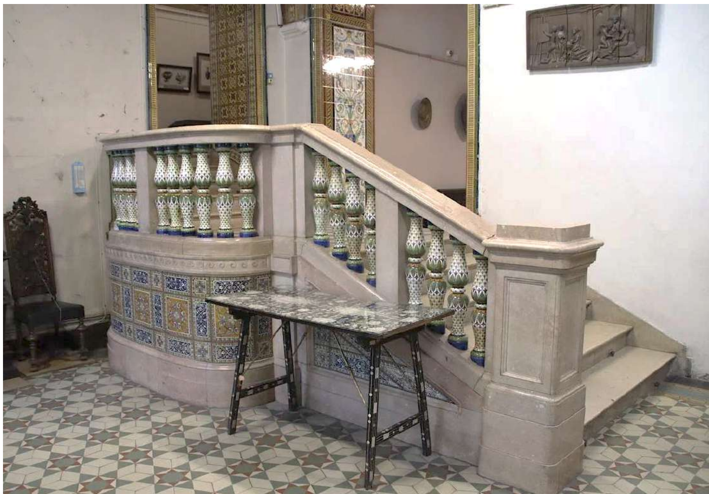
39. Зал Медичи (помещение 334 по ПИБ). Объект культурного наследия федерального значения «Музей», входящий в состав объекта культурного наследия федерального значения «Центральное училище технического рисования и музей Штиглица А.Л.». Санкт-Петербург, Соляной переулок, дом 13-15, литера В. Дата съемки: 15.06.2024.
