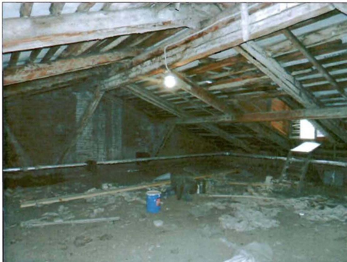
35. Стропильная система. Общий вид.
