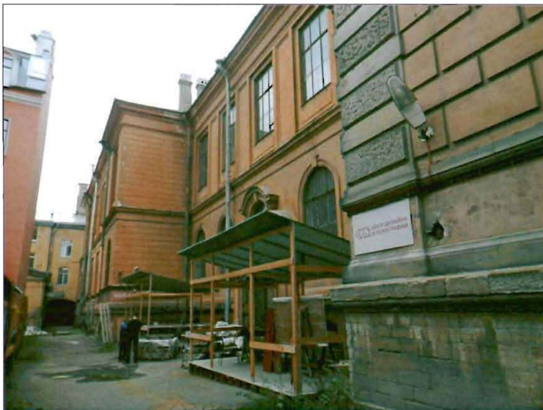
6. Южный дворовый фасад. Общий вид.
