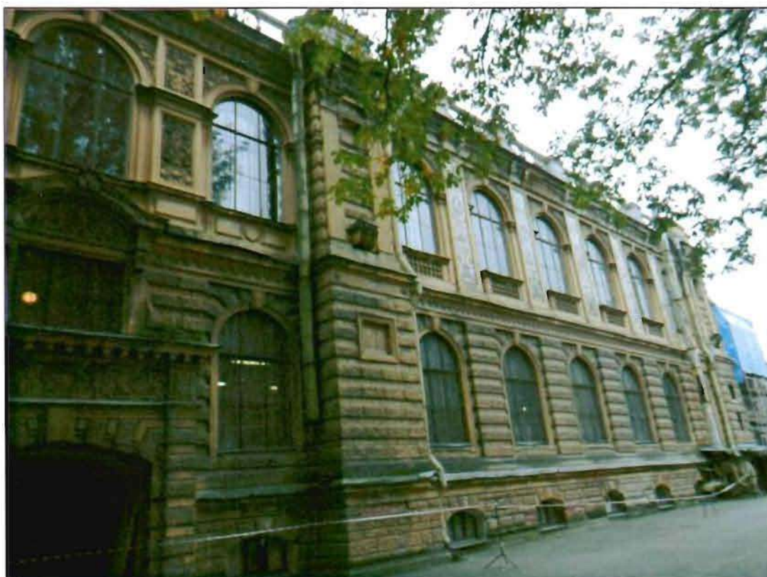
7. Северный дворовый фасад. Общий вид.
