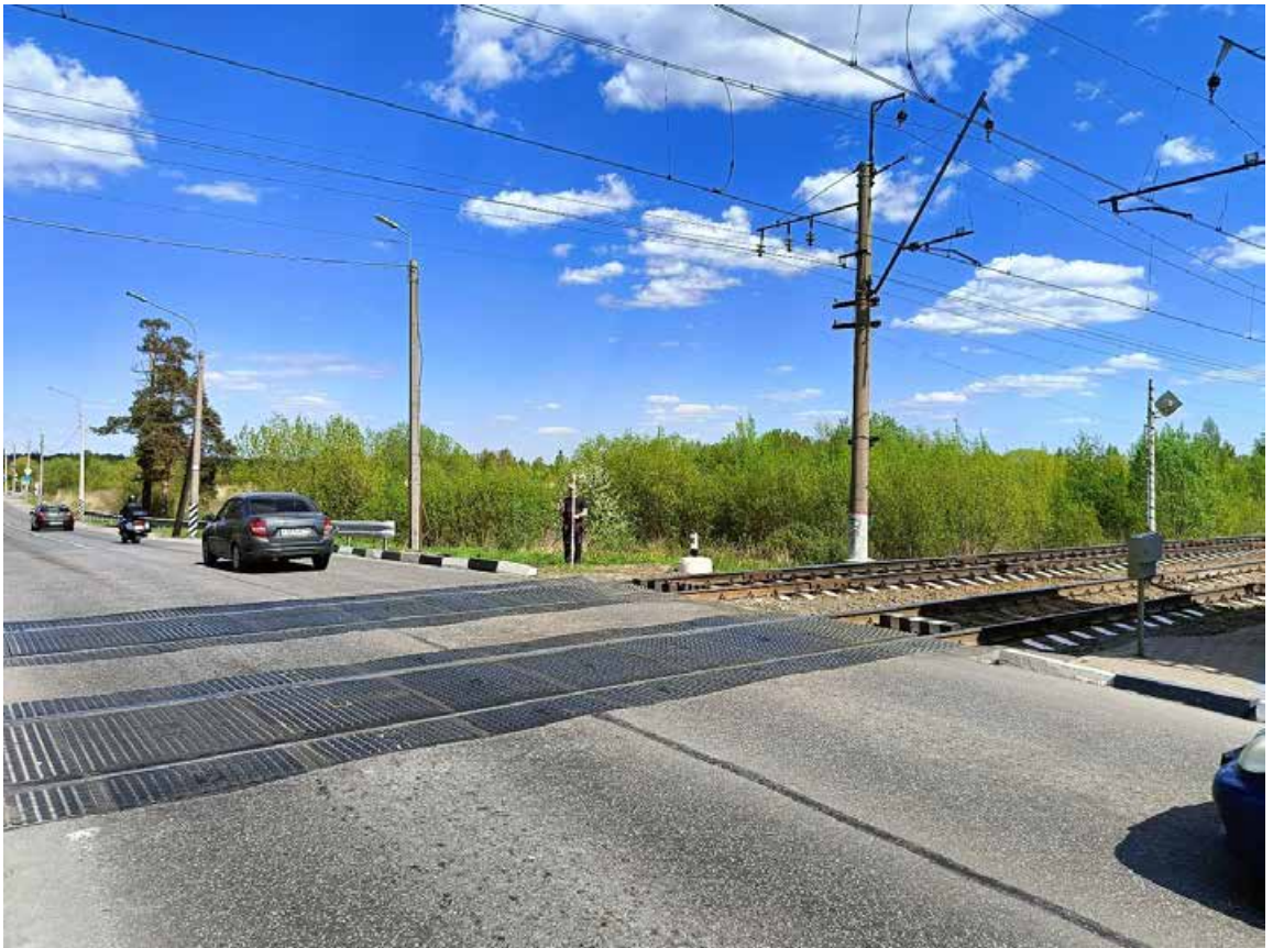
Рис. 26. СПб-2024. Г. Петергоф, Ропшинское ш., пересечение с ЖД. Точка фотофиксации 5, вид с запада.
