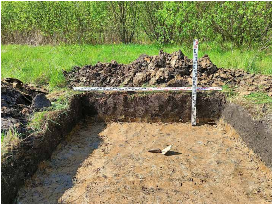
Рис. 44. СПб-2024. Г. Петергоф, Ропшинское ш., строительство. Шурф 1, западная стенка, вид с востока.
