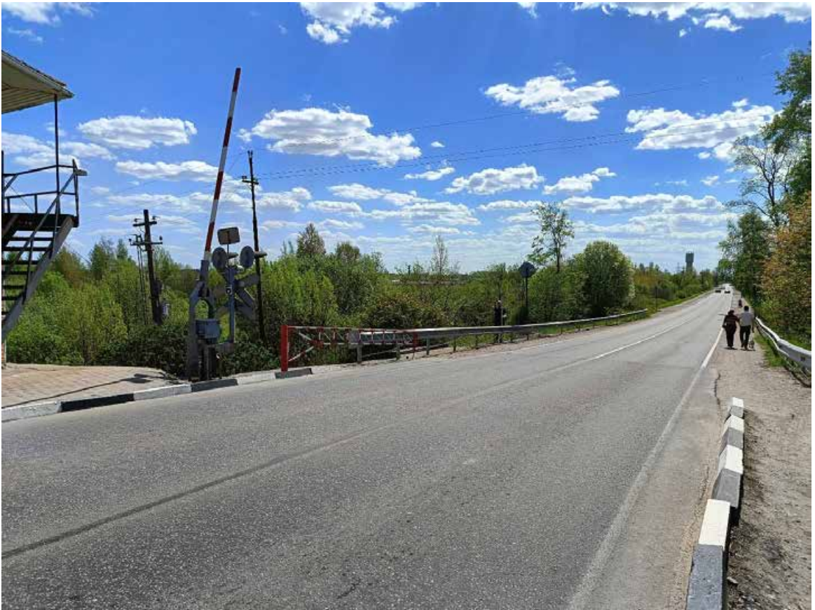
Рис. 23. СПб-2024. Г. Петергоф, Ропшинское ш., пересечение с ЖД. Точка фотофиксации 5, вид с севера.
