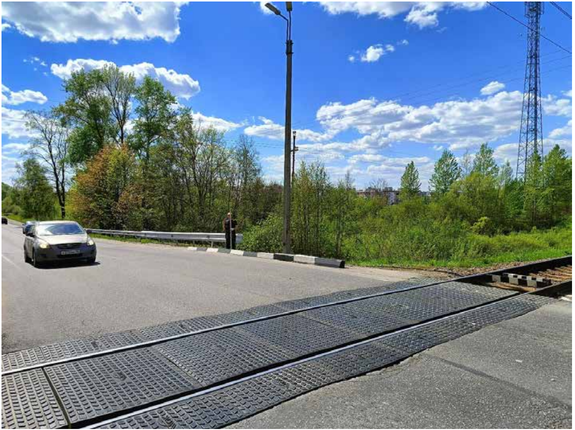
Рис. 25. СПб-2024. Г. Петергоф, Ропшинское ш., пересечение с ЖД. Точка фотофиксации 5, вид с востока.
