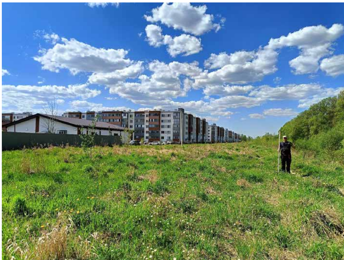
Рис. 30. СПб-2024. Г. Петергоф, Ропшинское ш., пересечение с ЖД. Точка фотофиксации 7, вид с востока.
