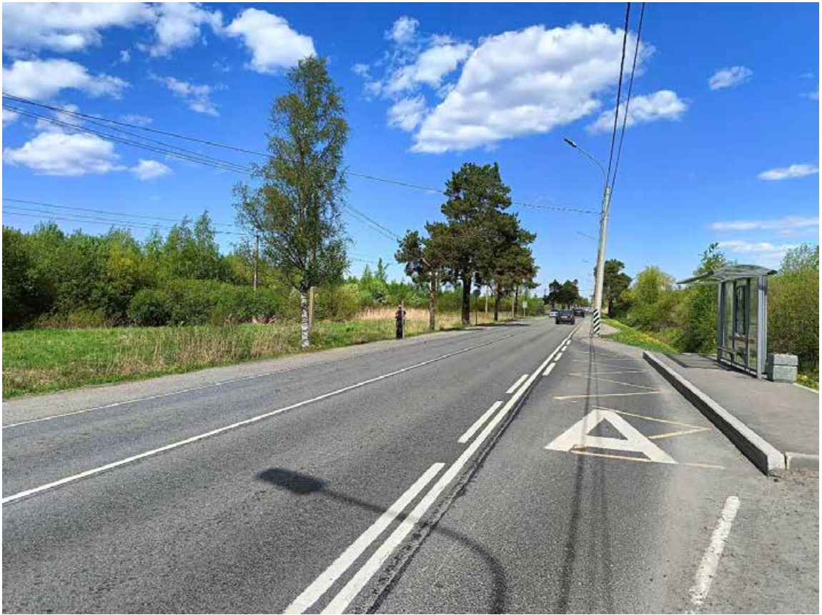
Рис. 21. СПб-2024. Г. Петергоф, Ропшинское ш., пересечение с ЖД. Точка фотофиксации 4, вид с юга.
