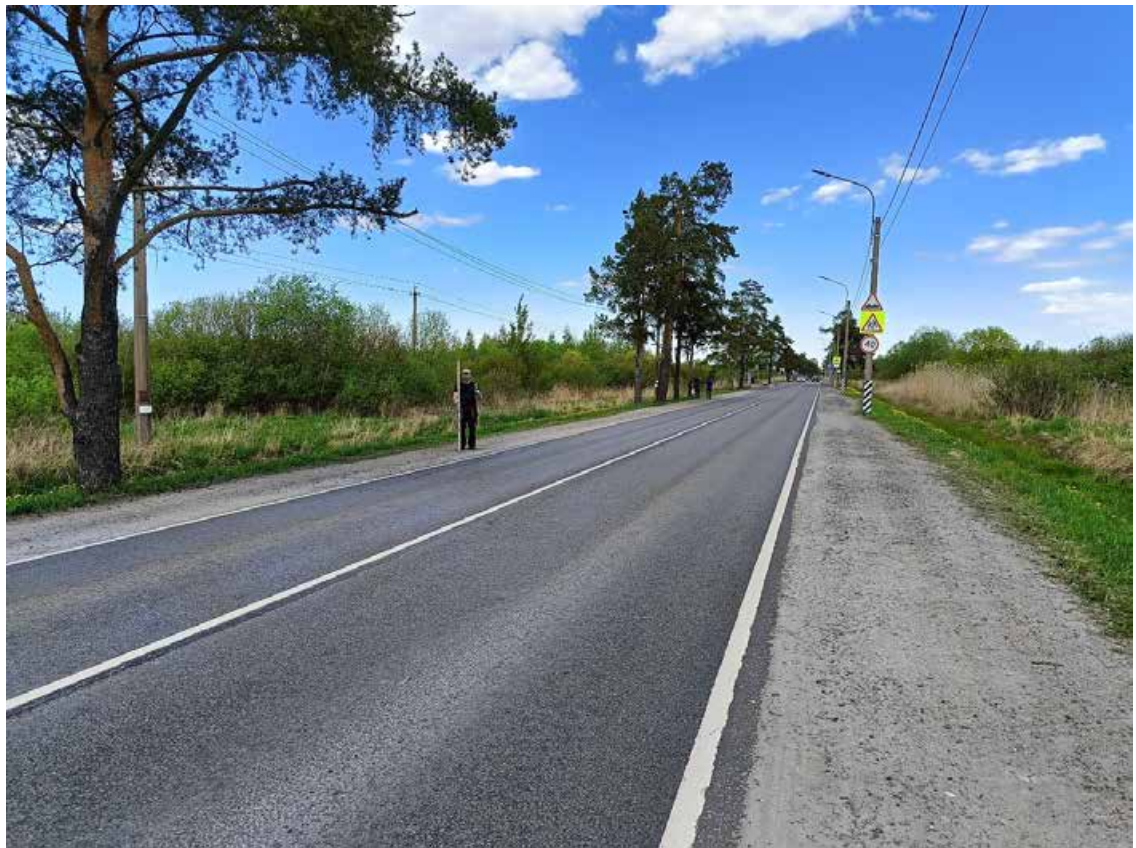
Рис. 18. СПб-2024. Г. Петергоф, Ропшинское ш., пересечение с ЖД. Точка фотофиксации 2, вид с юга.
