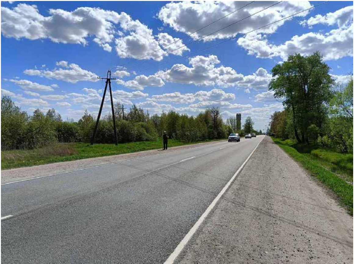
Рис. 32. СПб-2024. Г. Петергоф, Ропшинское ш., пересечение с ЖД. Точка фотофиксации 8, вид с севера.
