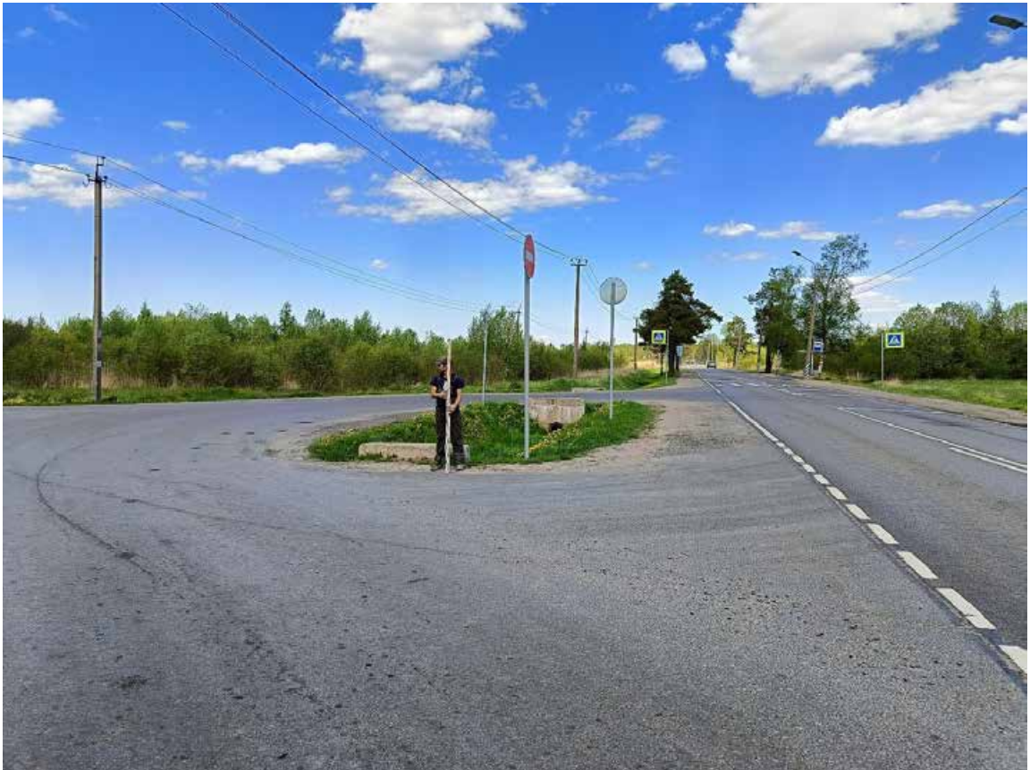
Рис. 15. СПб-2024. Г. Петергоф, Ропшинское ш., пересечение с ЖД. Точка фотофиксации 1, вид с юга.
