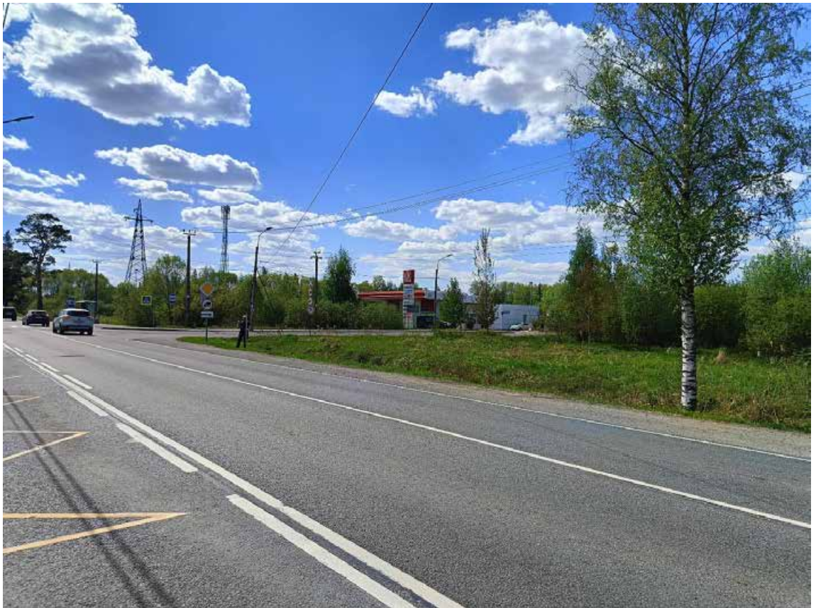
Рис. 22. СПб-2024. Г. Петергоф, Ропшинское ш., пересечение с ЖД. Точка фотофиксации 4, вид с востока.
