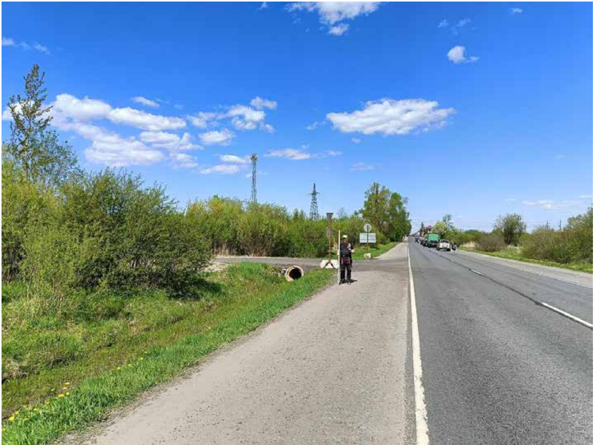
Рис. 31. СПб-2024. Г. Петергоф, Ропшинское ш., пересечение с ЖД. Точка фотофиксации 8, вид с юга.
