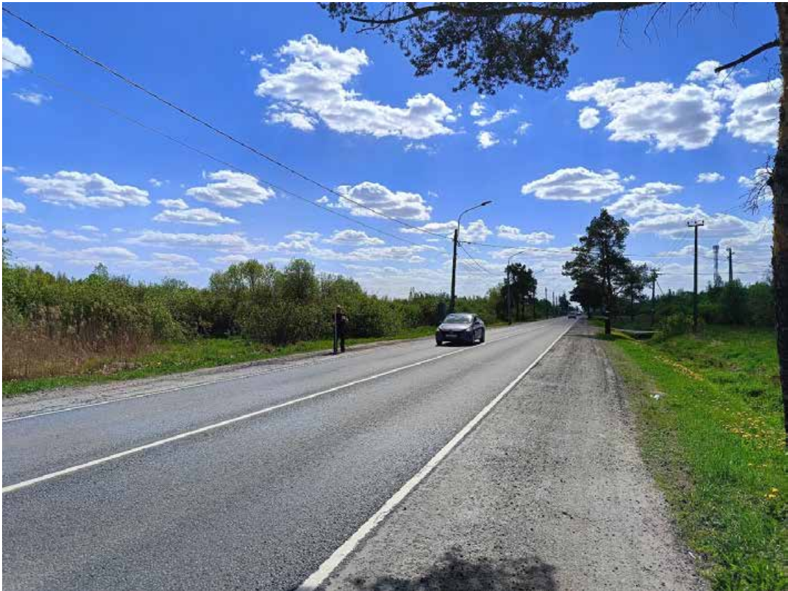
Рис. 17. СПб-2024. Г. Петергоф, Ропшинское ш., пересечение с ЖД. Точка фотофиксации 2, вид с севера.
