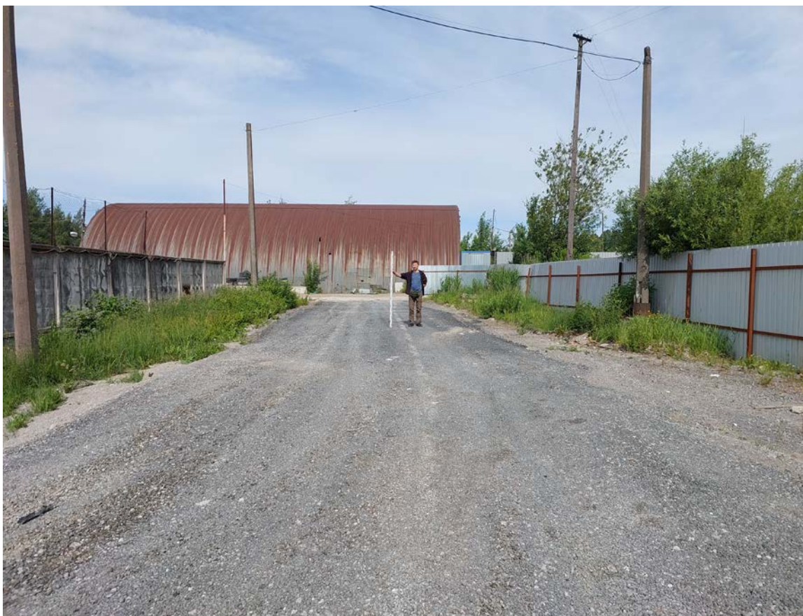
Илл. 25. Санкт-Петербург, поселок Парголово, Выборгское шоссе, дом 222, литера Б. Точка фотофиксации № 10. Вид с ЮВ. Для масштаба использована рейка длиной 2 м.
