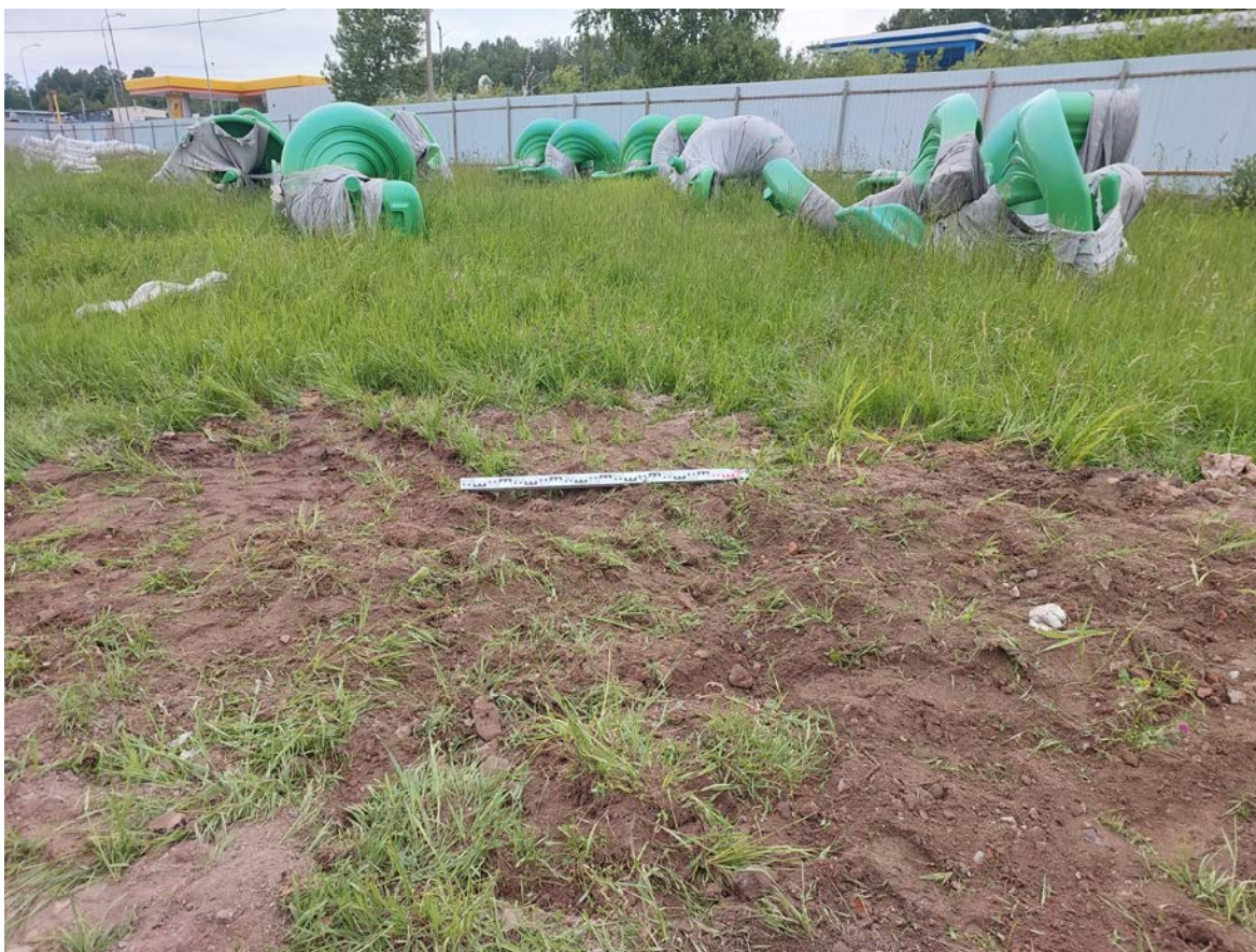
Илл. 37. Санкт-Петербург, поселок Парголово, Выборгское шоссе, дом 222, литера Б. Шурф 1. Рекультивация. Вид с Ю.
