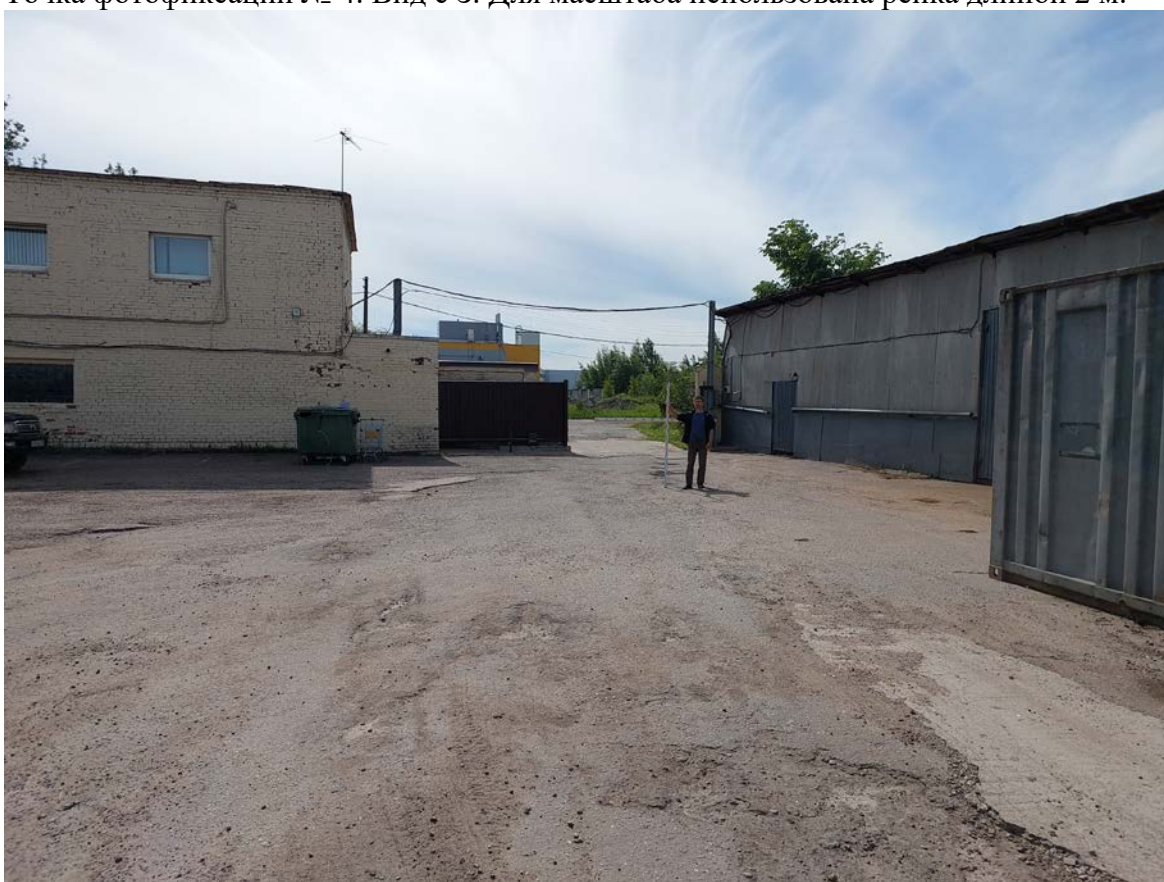
Илл. 20. Санкт-Петербург, поселок Парголово, Выборгское шоссе, дом 222, литера Б. Точка фотофиксации № 5. Вид с СЗ. Для масштаба использована рейка длиной 2 м.
