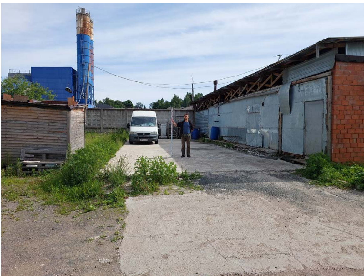
Илл. 23. Санкт-Петербург, поселок Парголово, Выборгское шоссе, дом 222, литера Б. Точка фотофиксации № 8. Вид с ЮЗ. Для масштаба использована рейка длиной 2 м.
