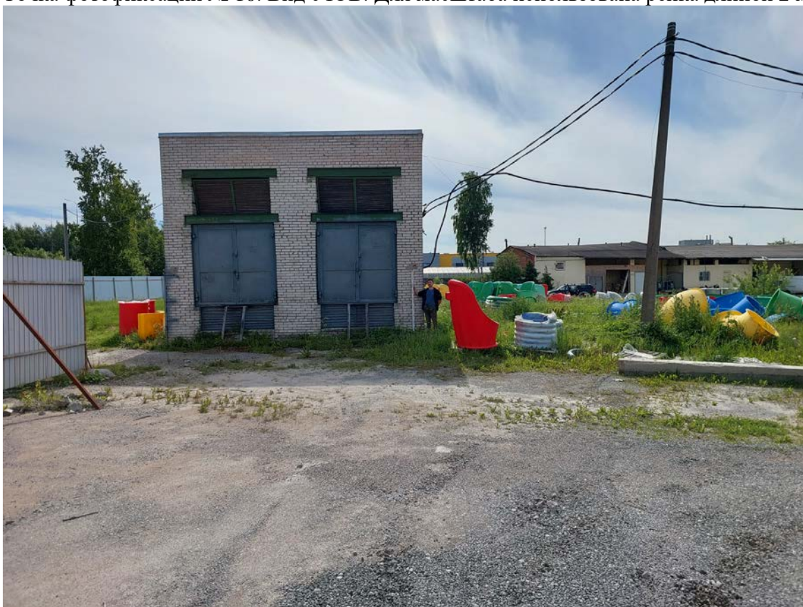
Илл. 26. Санкт-Петербург, поселок Парголово, Выборгское шоссе, дом 222, литера Б. Точка фотофиксации № 11. Вид с СЗ. Для масштаба использована рейка длиной 2 м.
