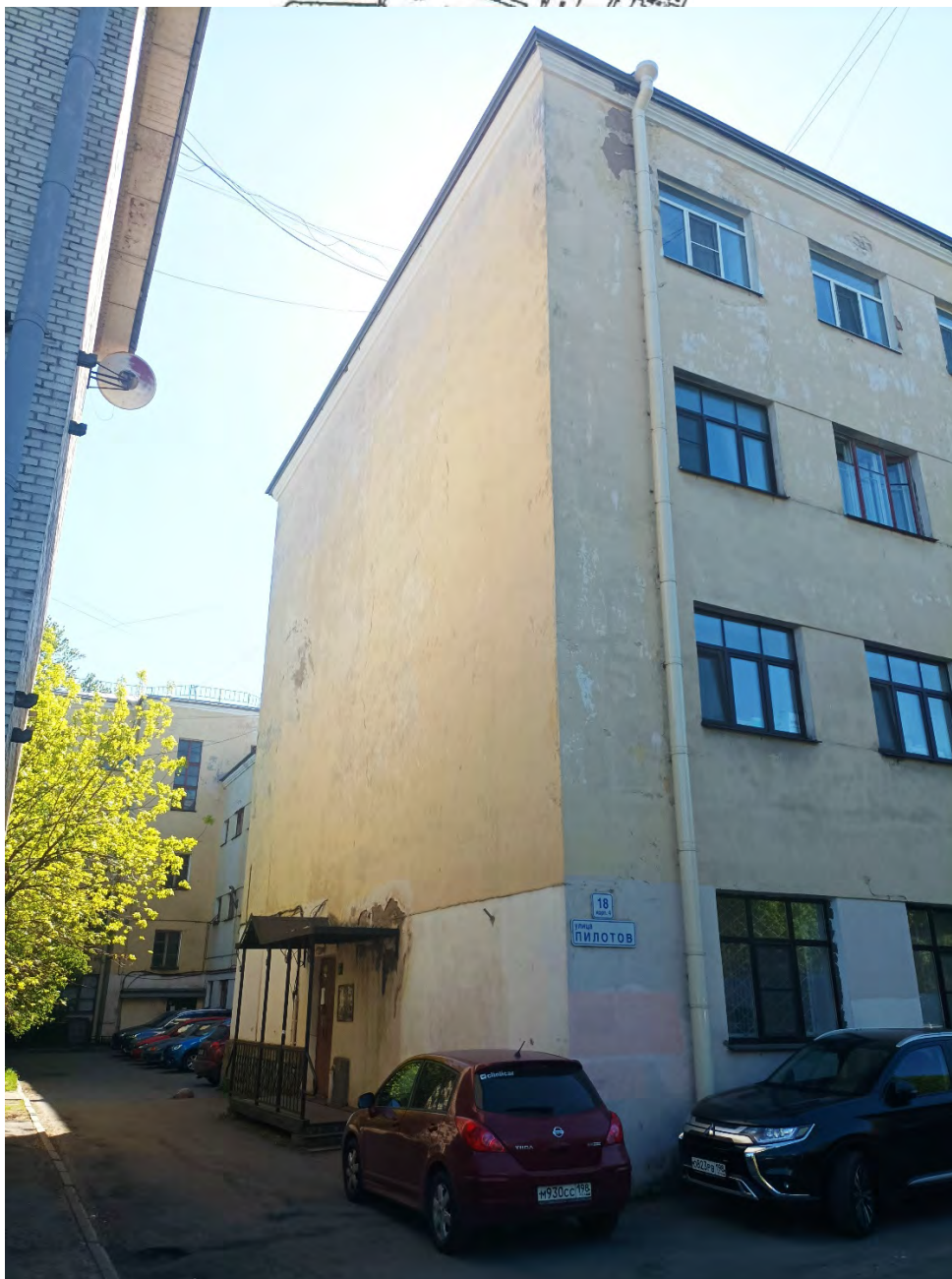
9. Объект культурного наследия регионального значения «Здание Института инженеров Гражданского воздушного флота». Вид объекта с северо-востока. Фрагмент фасада. Дата съемки: 02.05.2024г.
