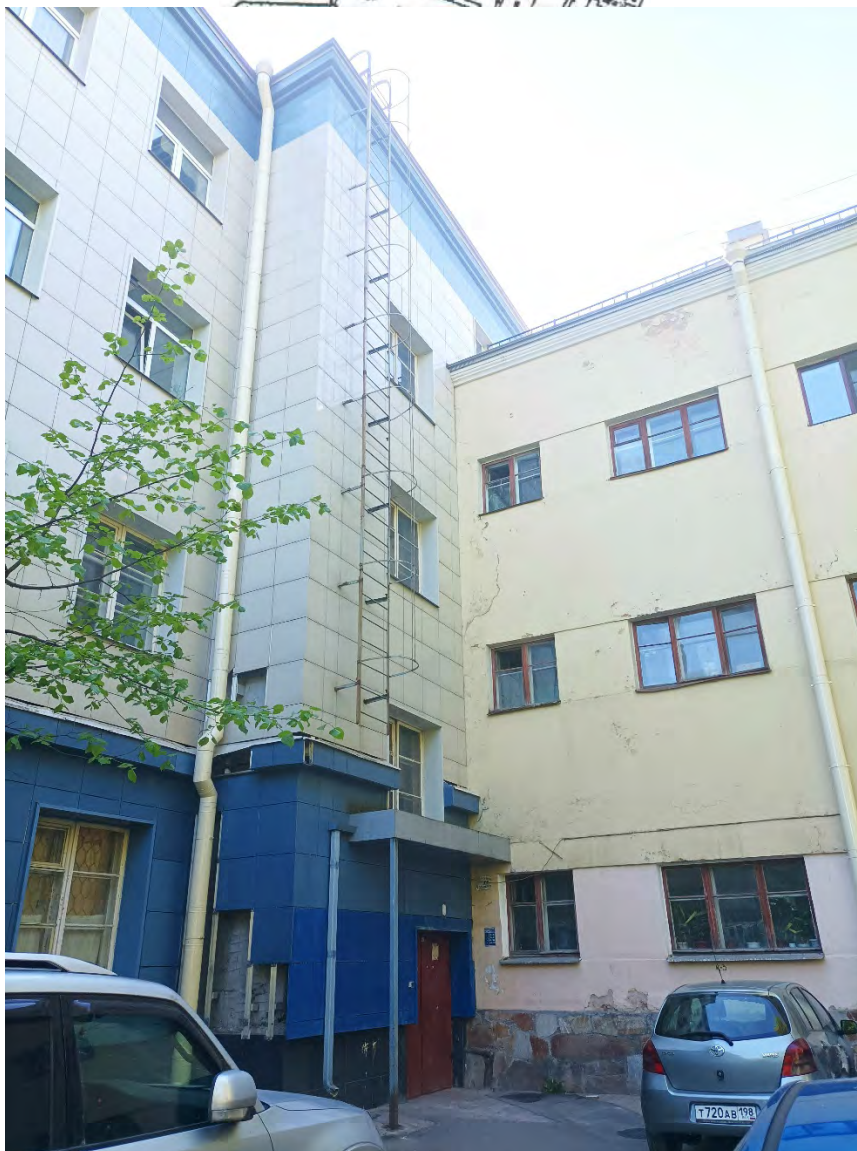
15. Объект культурного наследия регионального значения «Здание Института инженеров Гражданского воздушного флота». Вид объекта с востока. Фрагмент фасада. Дата съемки: 02.05.2024г.
