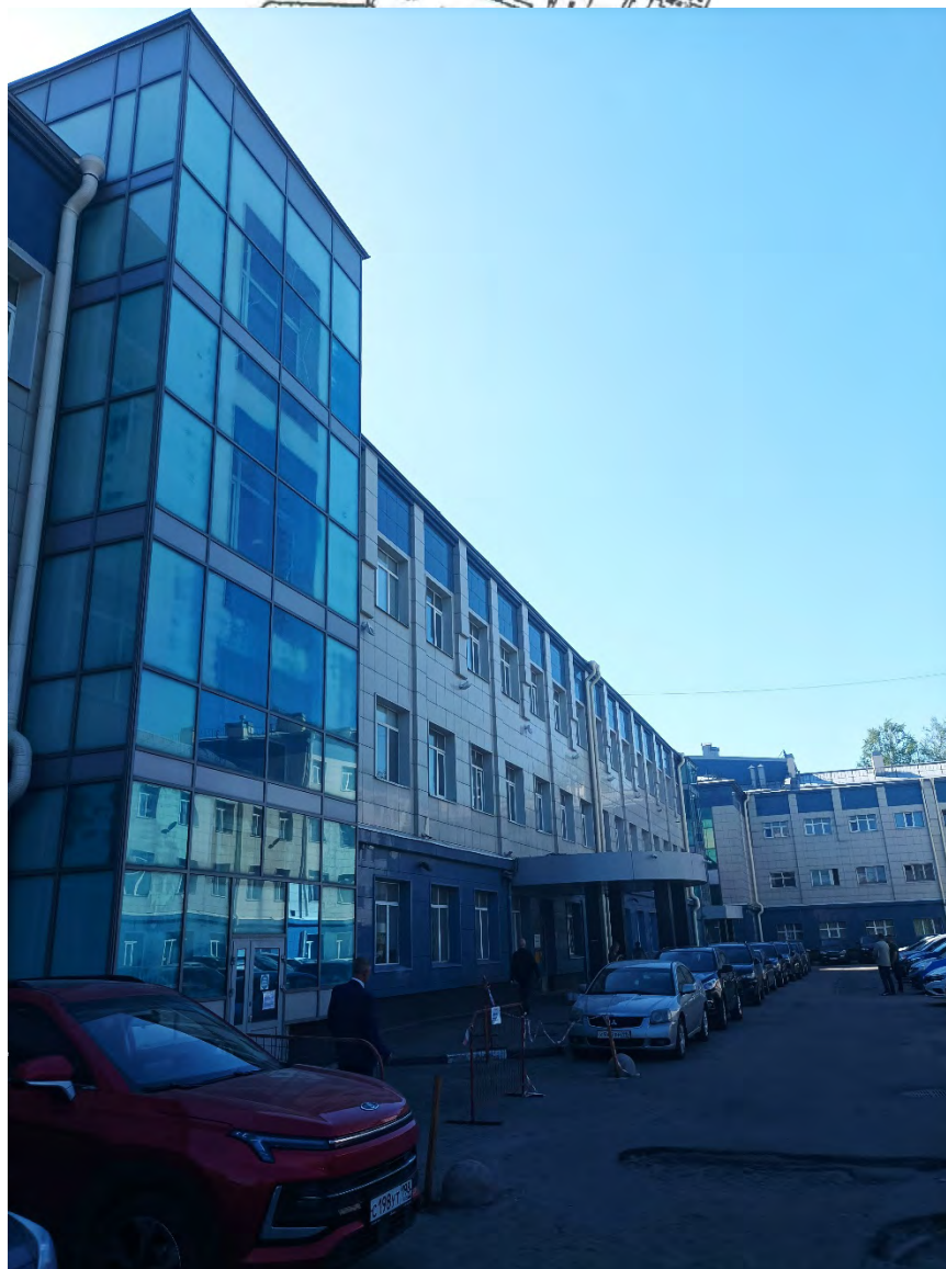
18. Объект культурного наследия регионального значения «Здание Института инженеров Гражданского воздушного флота». Вид объекта с востока. Фрагмент фасада. Дата съемки: 02.05.2024г.
