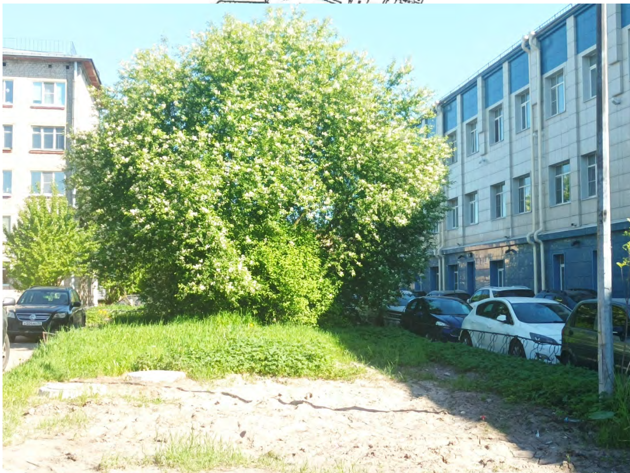
22. Объект культурного наследия регионального значения «Здание Института инженеров Гражданского воздушного флота». Земельный участок проектирования реконструкции тепловых сетей. Дата съемки: 02.05.2024г.
