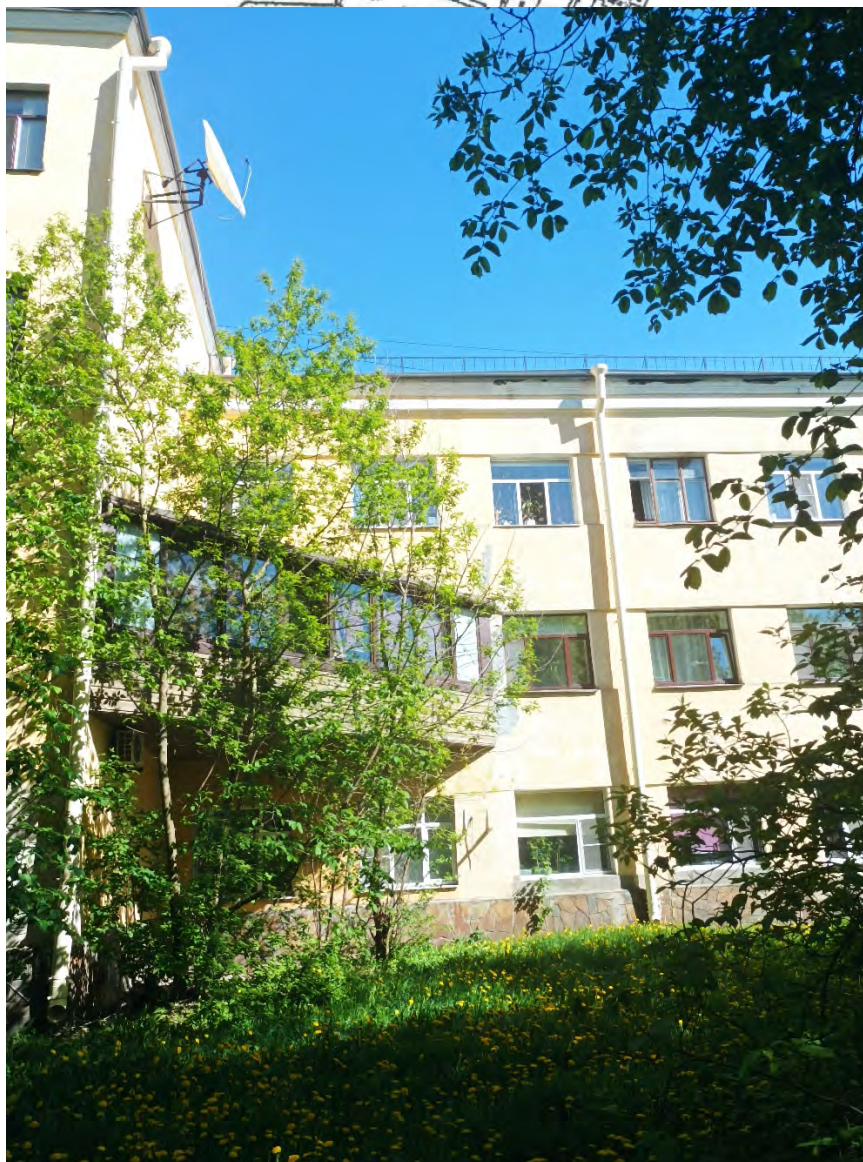
7. Объект культурного наследия регионального значения «Здание Института инженеров Гражданского воздушного флота». Вид объекта с запада. Фрагмент фасада. Дата съемки: 02.05.2024г.
