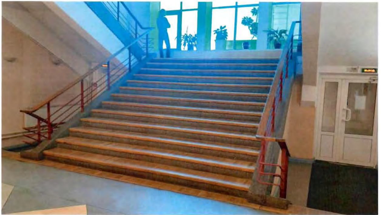
6. Распашная лестница в главном корпусе (пом. 10-Н(2)).
