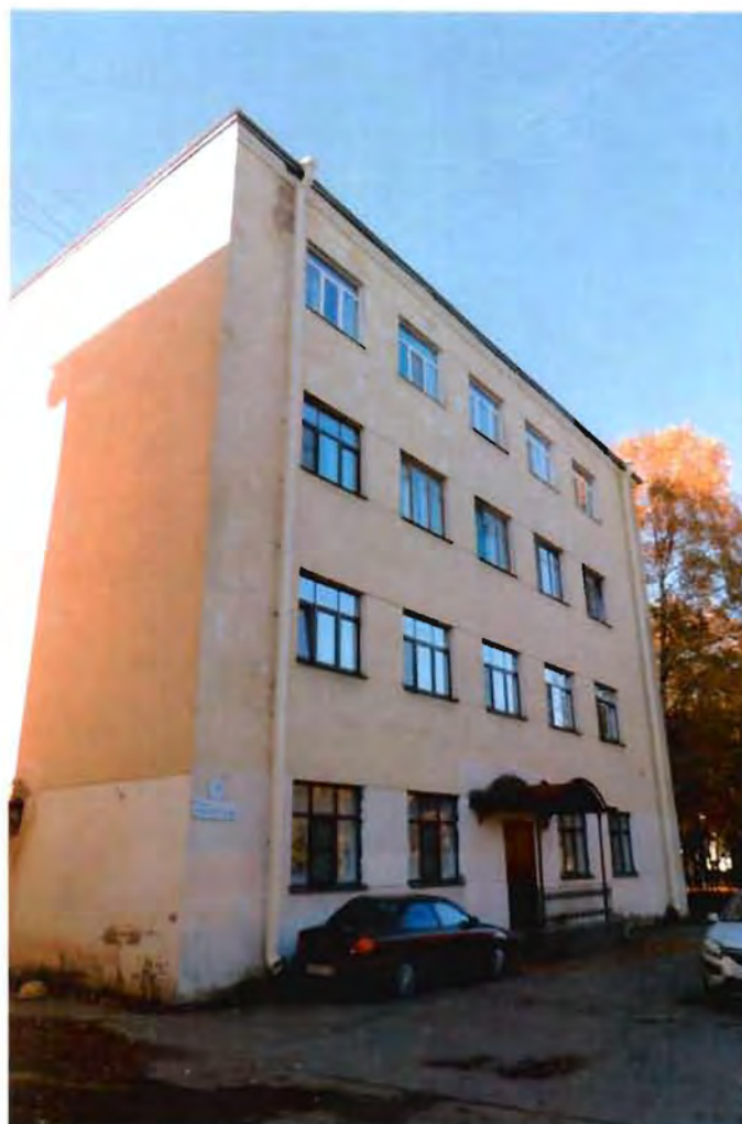
4. Торцевой северный корпус.
