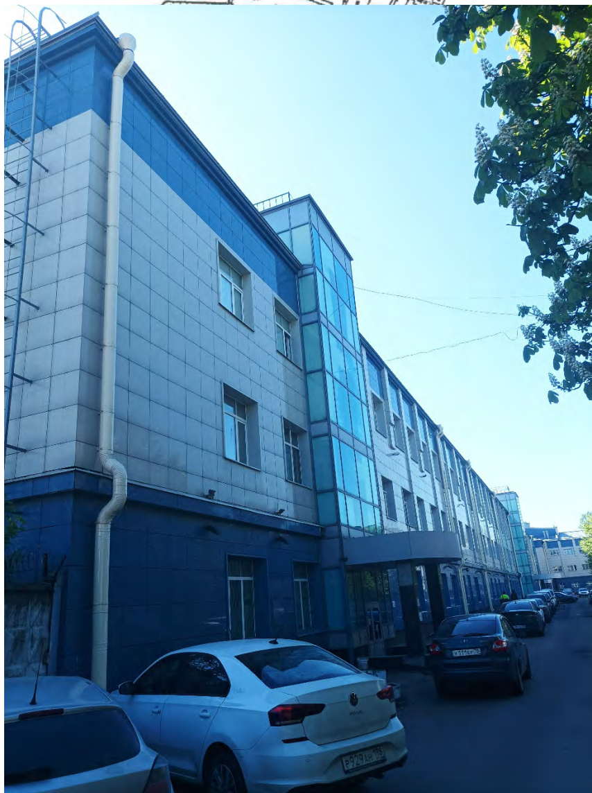
21. Объект культурного наследия регионального значения «Здание Института инженеров Гражданского воздушного флота». Вид объекта с востока. Фрагмент фасада. Дата съемки: 02.05.2024г.
