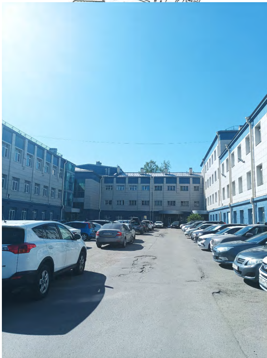
16. Объект культурного наследия регионального значения «Здание Института инженеров Гражданского воздушного флота». Вид объекта с востока. Фрагмент фасада. Дата съемки: 02.05.2024г.
