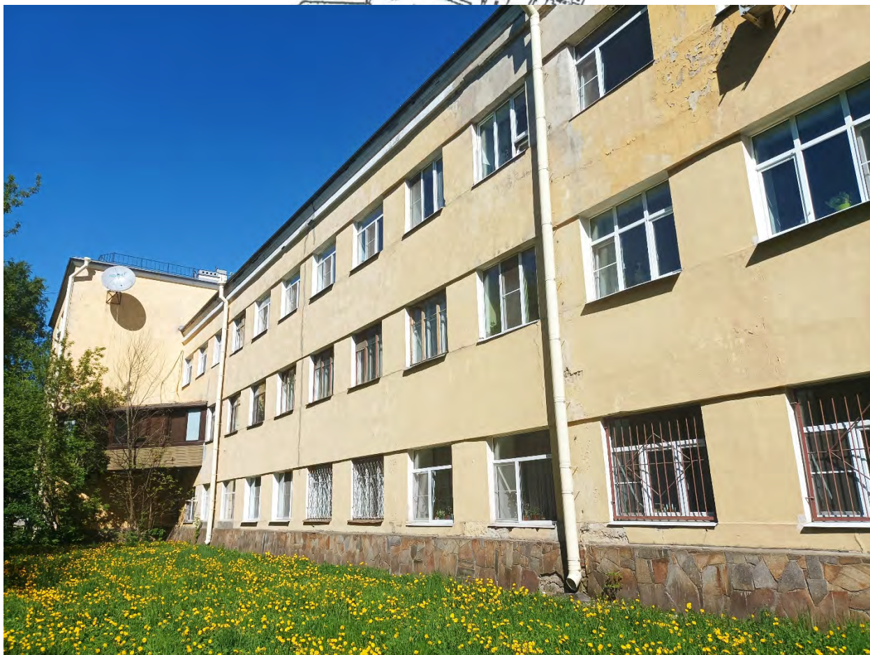
6. Объект культурного наследия регионального значения «Здание Института инженеров Гражданского воздушного флота». Вид объекта с юго-запада. Фрагмент фасада. Дата съемки: 02.05.2024г.
