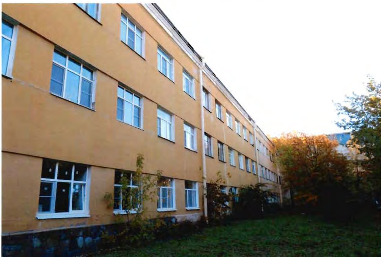
3. Поперечный жилой корпус, западный фасад.
