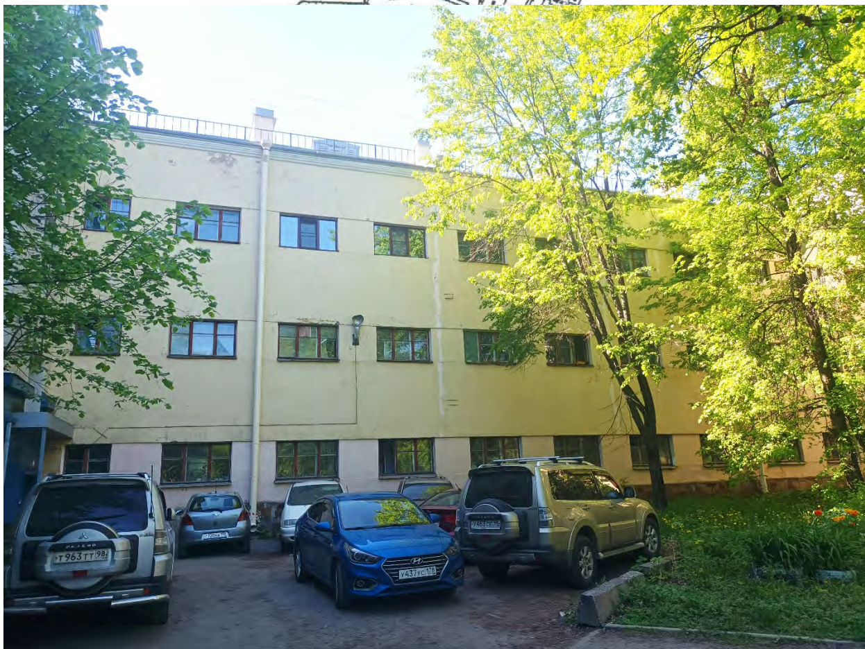
13. Объект культурного наследия регионального значения «Здание Института инженеров Гражданского воздушного флота». Вид объекта с востока. Фрагмент фасада. Дата съемки: 02.05.2024г.
