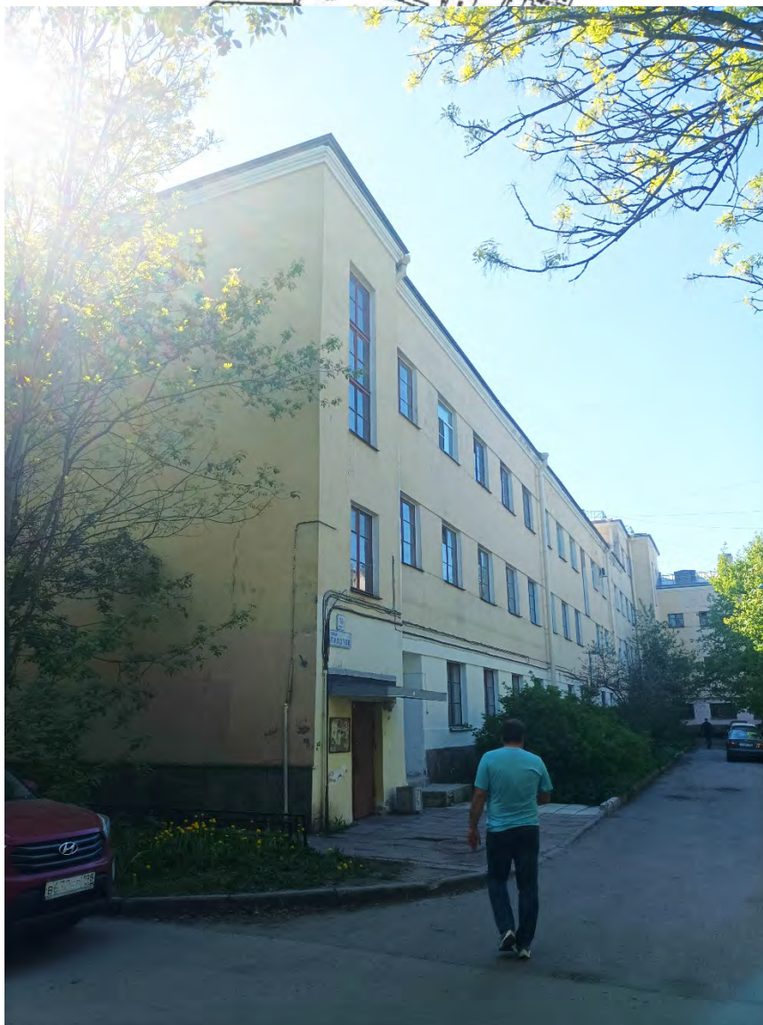
10. Объект культурного наследия регионального значения «Здание Института инженеров Гражданского воздушного флота». Вид объекта с востока. Фрагмент фасада. Дата съемки: 02.05.2024г.
