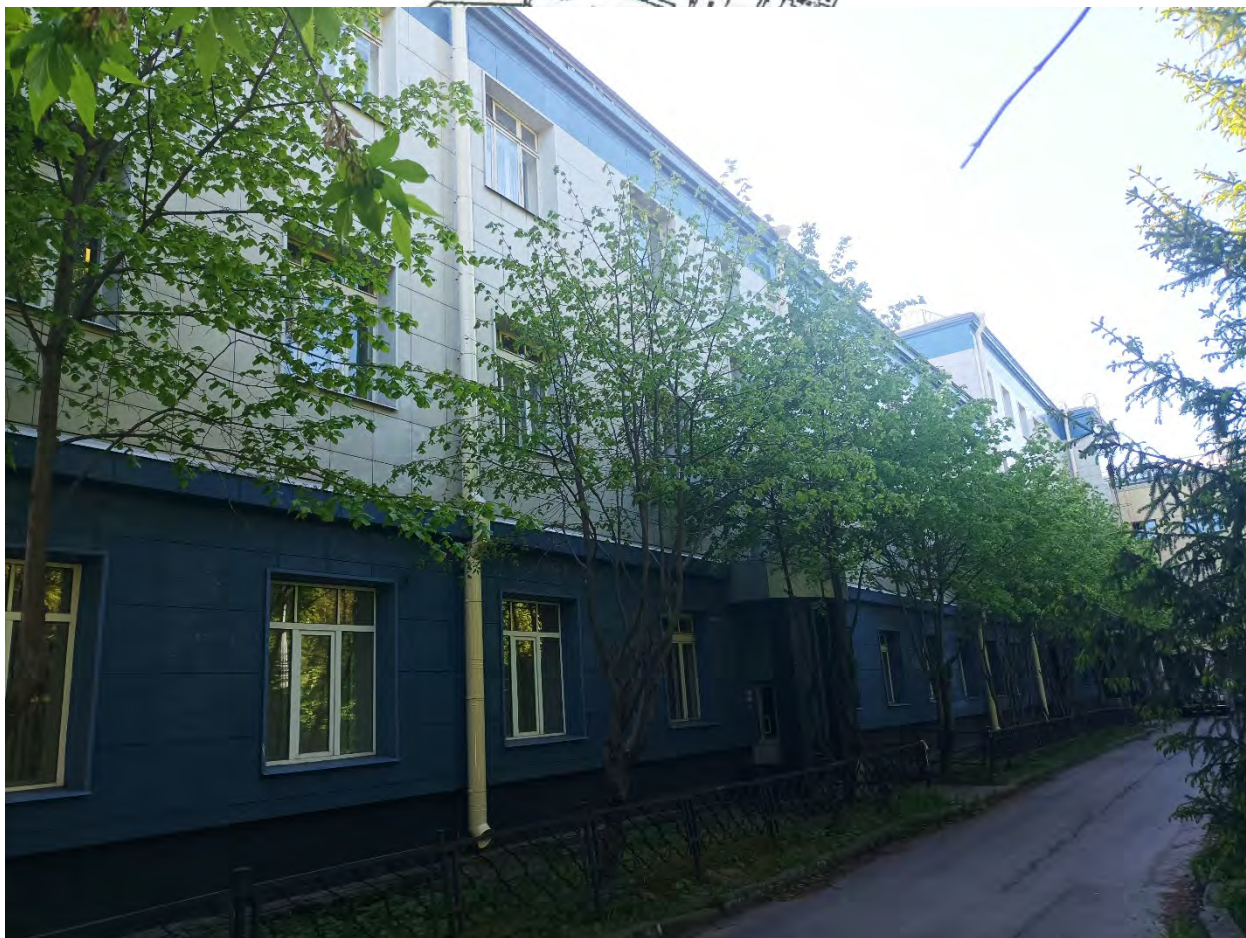
14. Объект культурного наследия регионального значения «Здание Института инженеров Гражданского воздушного флота». Вид объекта с востока. Фрагмент фасада. Дата съемки: 02.05.2024г.
