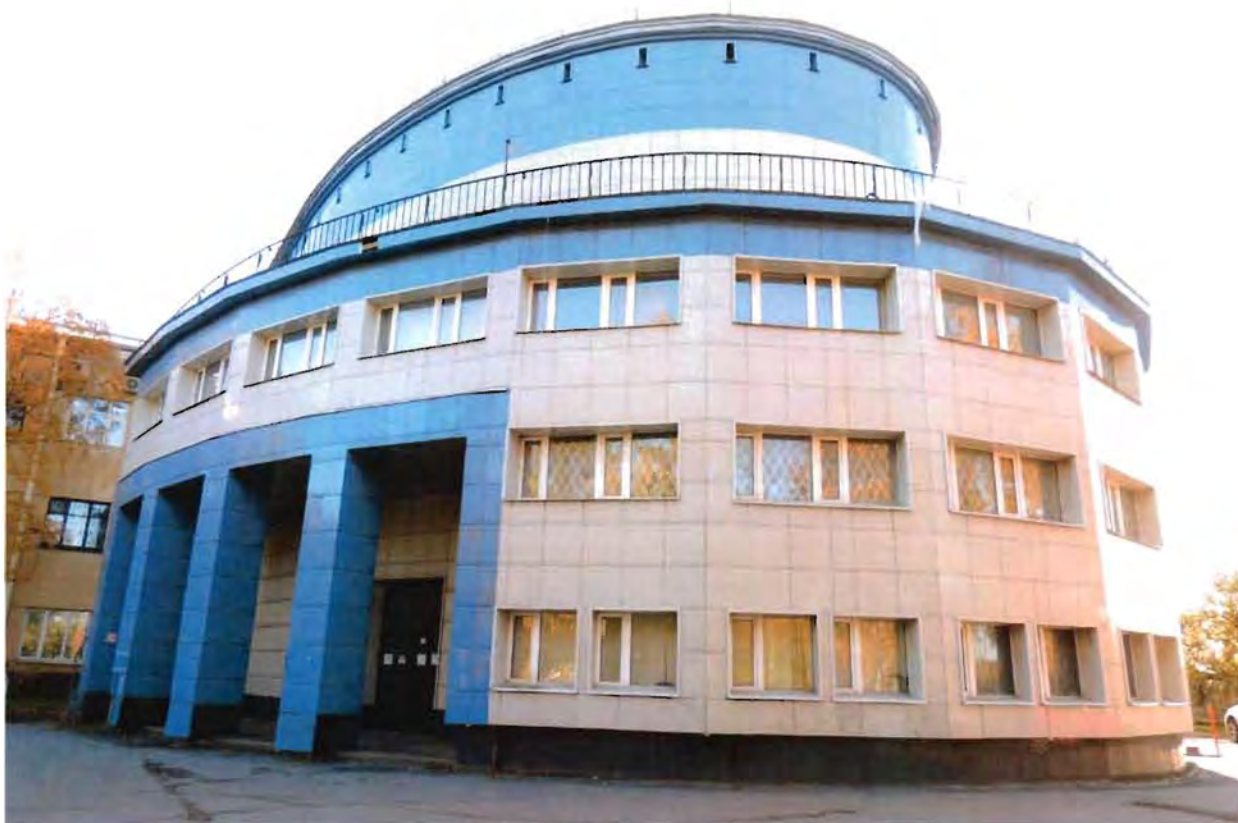
2. Главный корпус, вид с запада.
