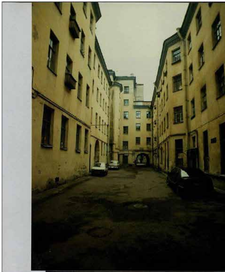
Санкт-Петербург, Центральный район ул. Моховая, дд. 27-29 Дом доходный Страхового общества "Россия" 1838 г., 1882 г., 1897 г. арх. Л. Бенуа. Северо-западный двор. Вид с севера. Сентябрь 1999 г., фото В. П. Орлова Фото № 12
