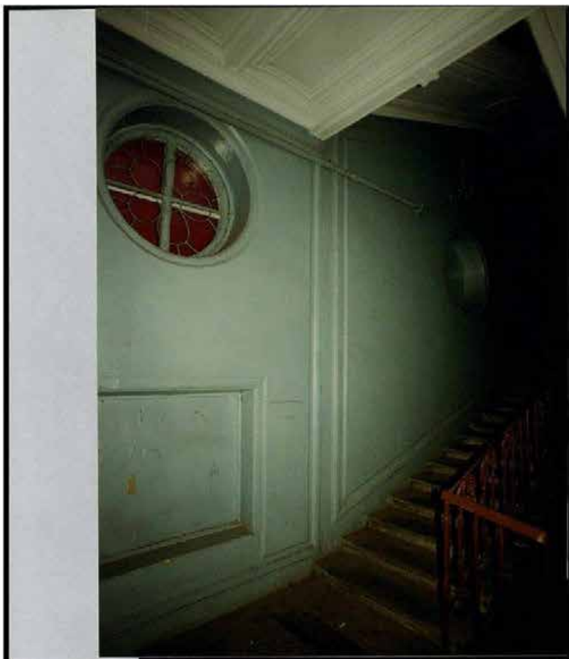
Санкт-Петербург, Центральный район ул. Моховая, дд. 27-29 Доходный дом Страхового общества "Россия" 1838 г., 1882 г., 1897 г., арх. Л. Бенуа. Северный корпус (№1). Северная парадная лестница. Площадка между 1 и 2 этажами. Вид с юга Сентябрь 1999 г., фото В. П. Орлова Фото № 25
