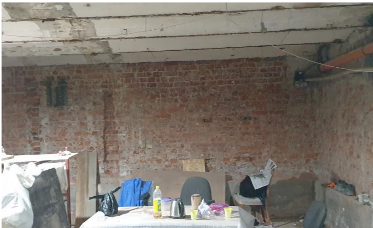
Фото 11 – Помещение подвала в осях В-Г/10
