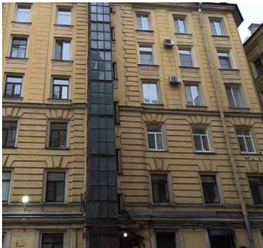
Фото 2 – Фрагмент дворового фасада
