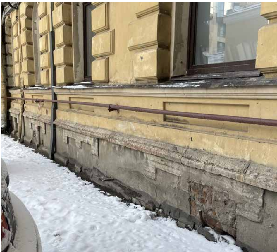
Фото 5 – Фрагмент дворового фасада здания
