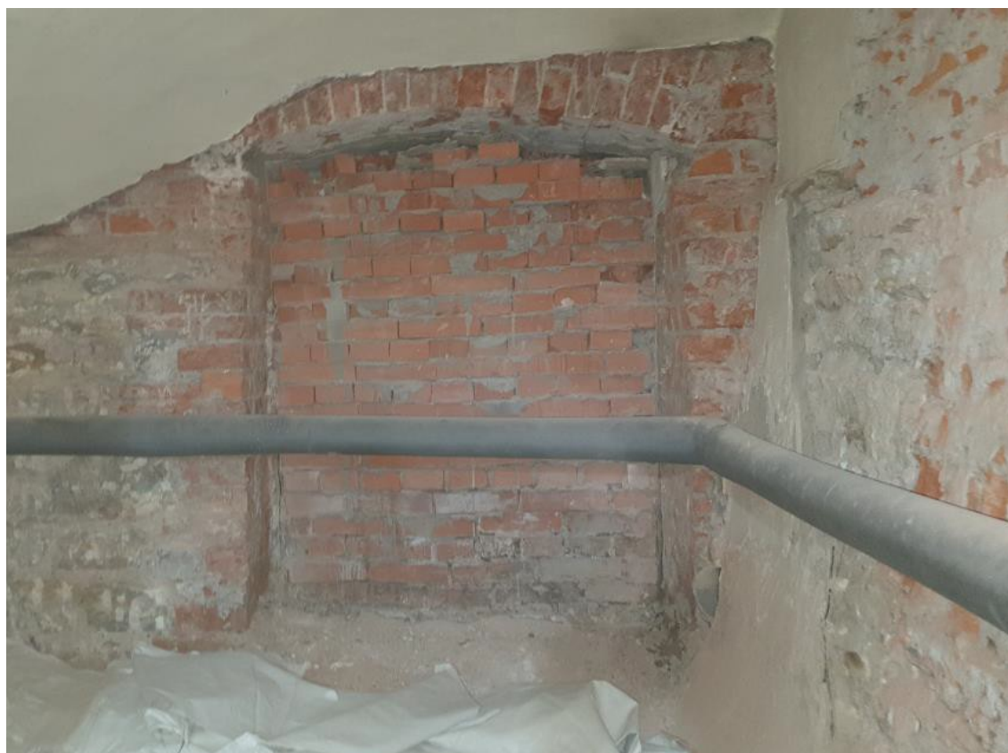
Фото 10 – Помещение подвала в осях Г/10-11
