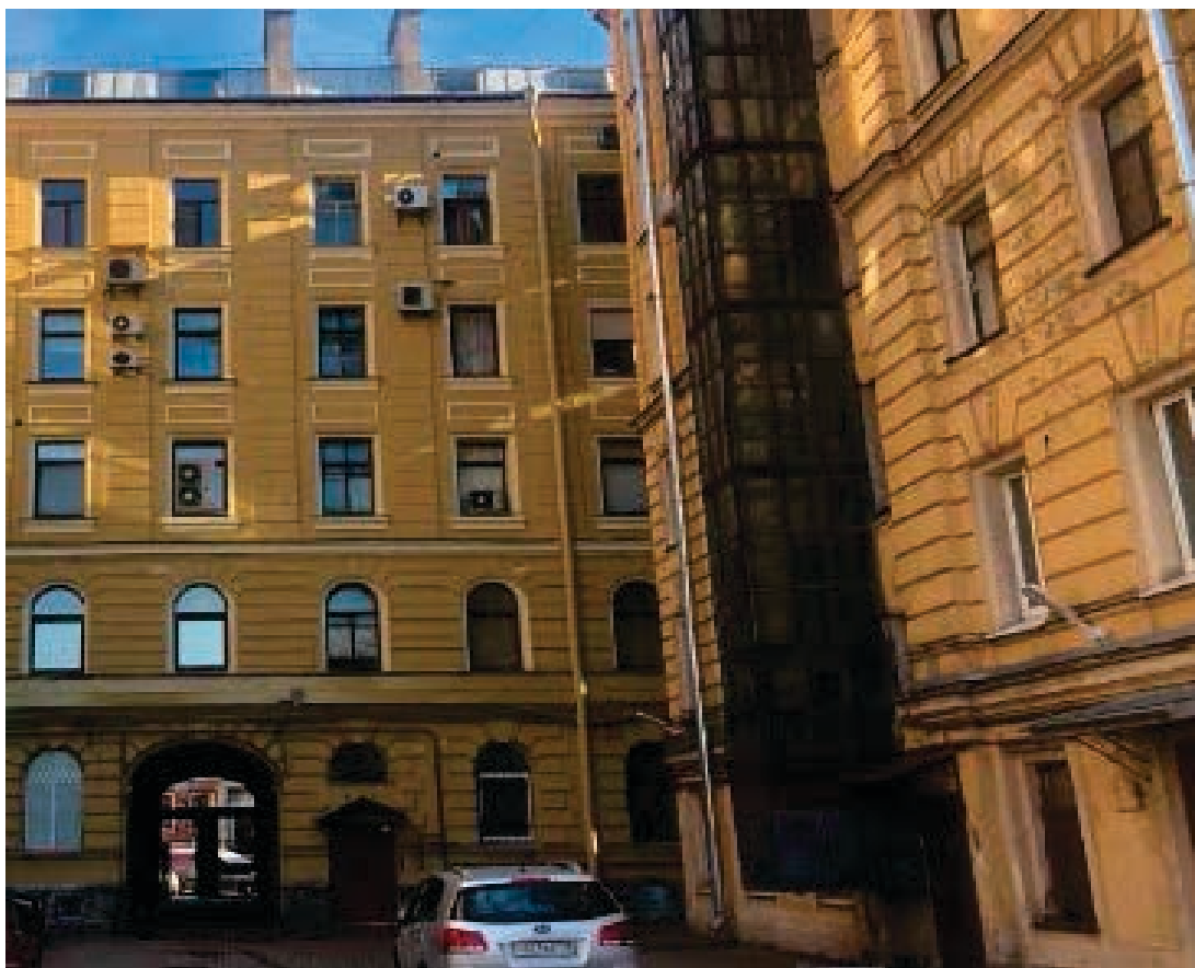
Фото 22 – Вход в пом. 13-Н со стороны двора.
