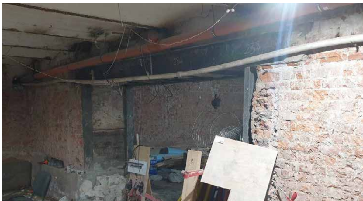
Фото 12 – Помещение подвала в осях В/10-11
