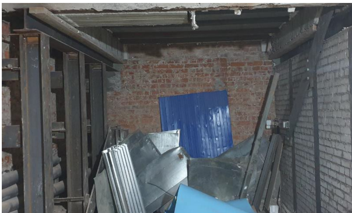
Фото 18 – Помещение подвала в осях А-Б/10-11
