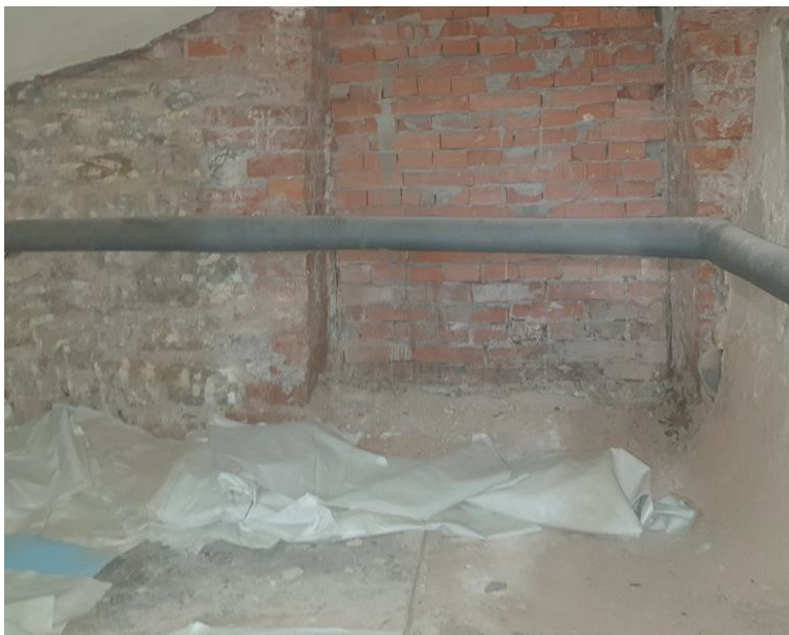
Фото 20 – Помещение подвала в осях Г/10-11
