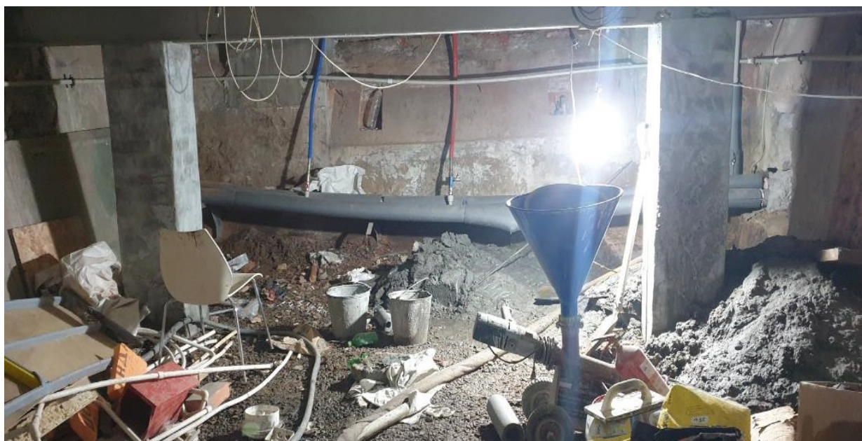
Фото 9 – Помещение подвала в осях А/11-12
