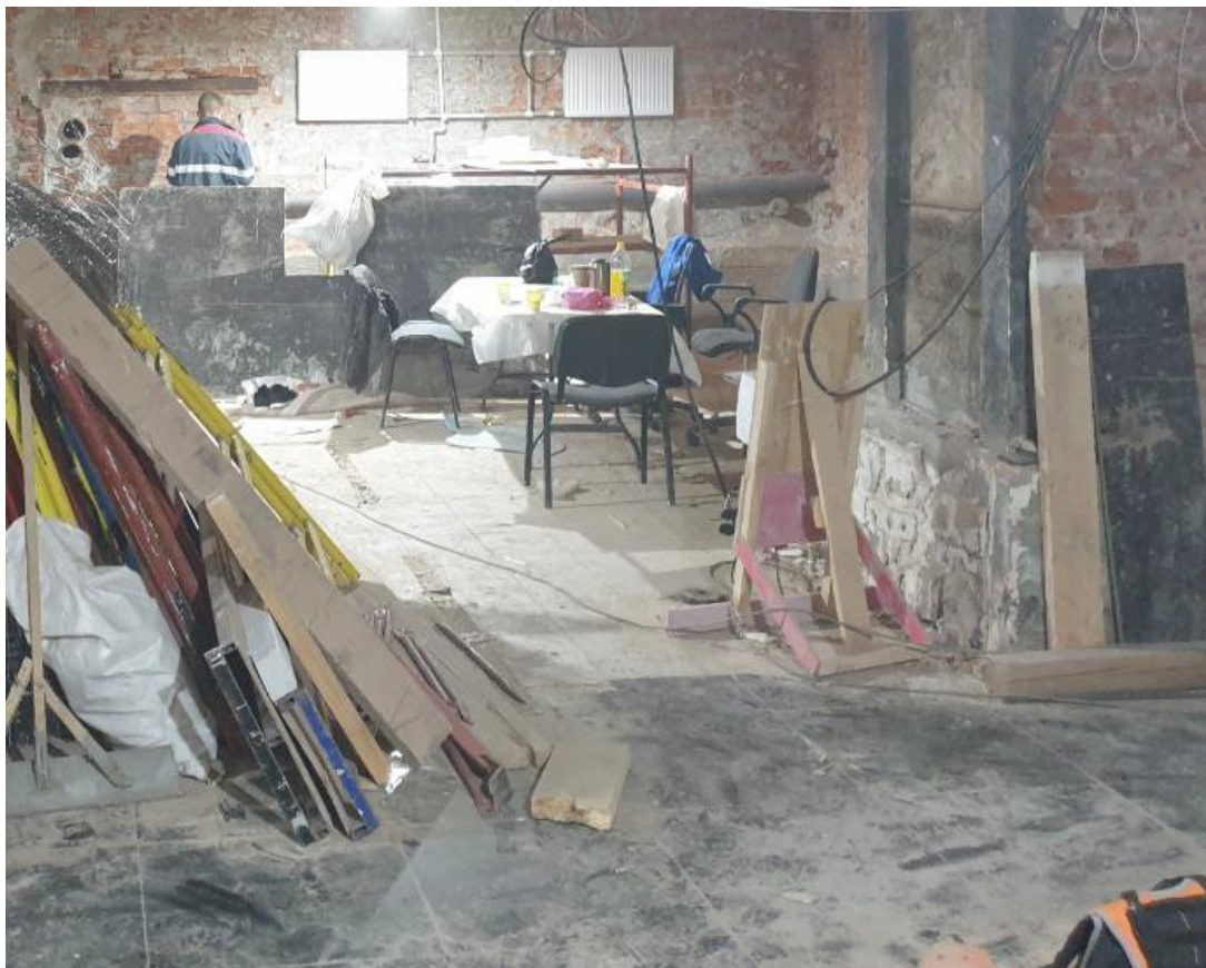
Фото 21 – Помещение подвала в осях А-Г/10-11
