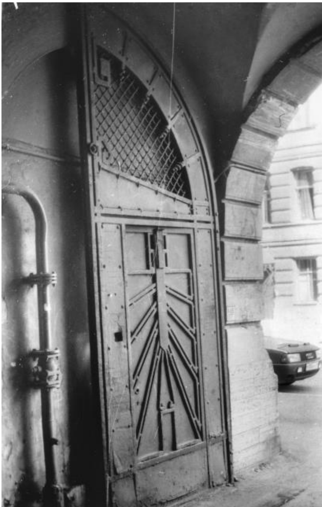
Илл. 24. Створка ворот арочного проезда жилого дома № 2 по улице Блохина (бывший доходный дом Л.Л. Кенига, архитектор К.К. Шмидт, 1911-1912 гг.). 27.05.2003 г. (источник: ЦГАКФФД СПб. Фотодокументы. Опись 1АР-157. Ед.хр.225452).
