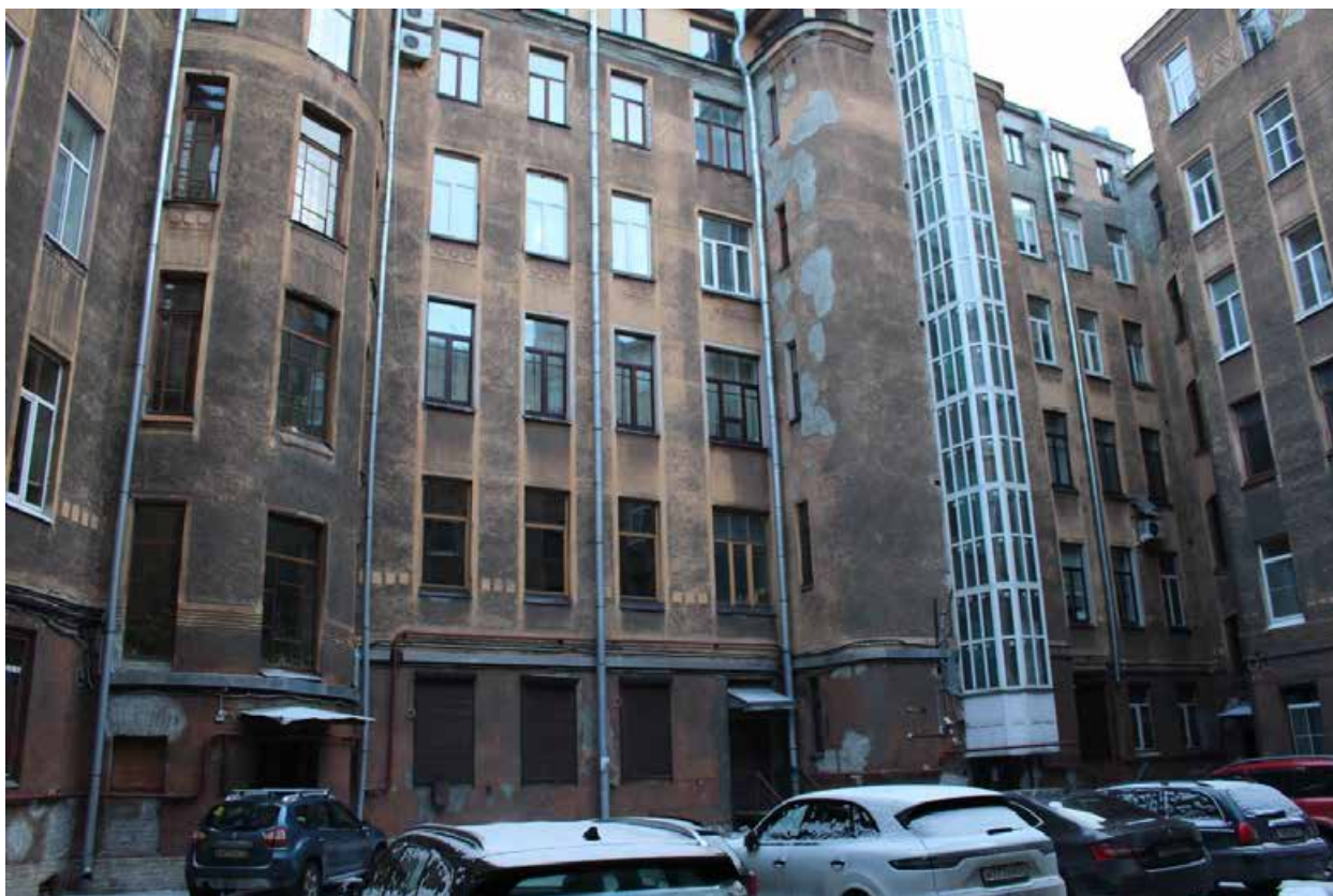
Фото 23. Вид на восточный дворовый фасад объекта культурного наследия регионального значения «Дом Л.Л. Кенига».
