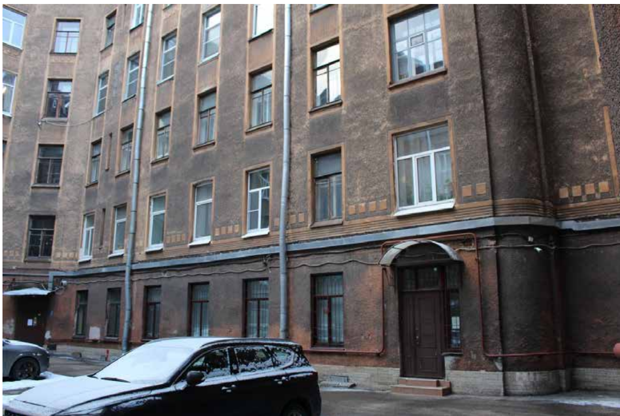
Фото 19. Вид на западный дворовый фасад объекта культурного наследия регионального значения «Дом Л.Л. Кенига».
