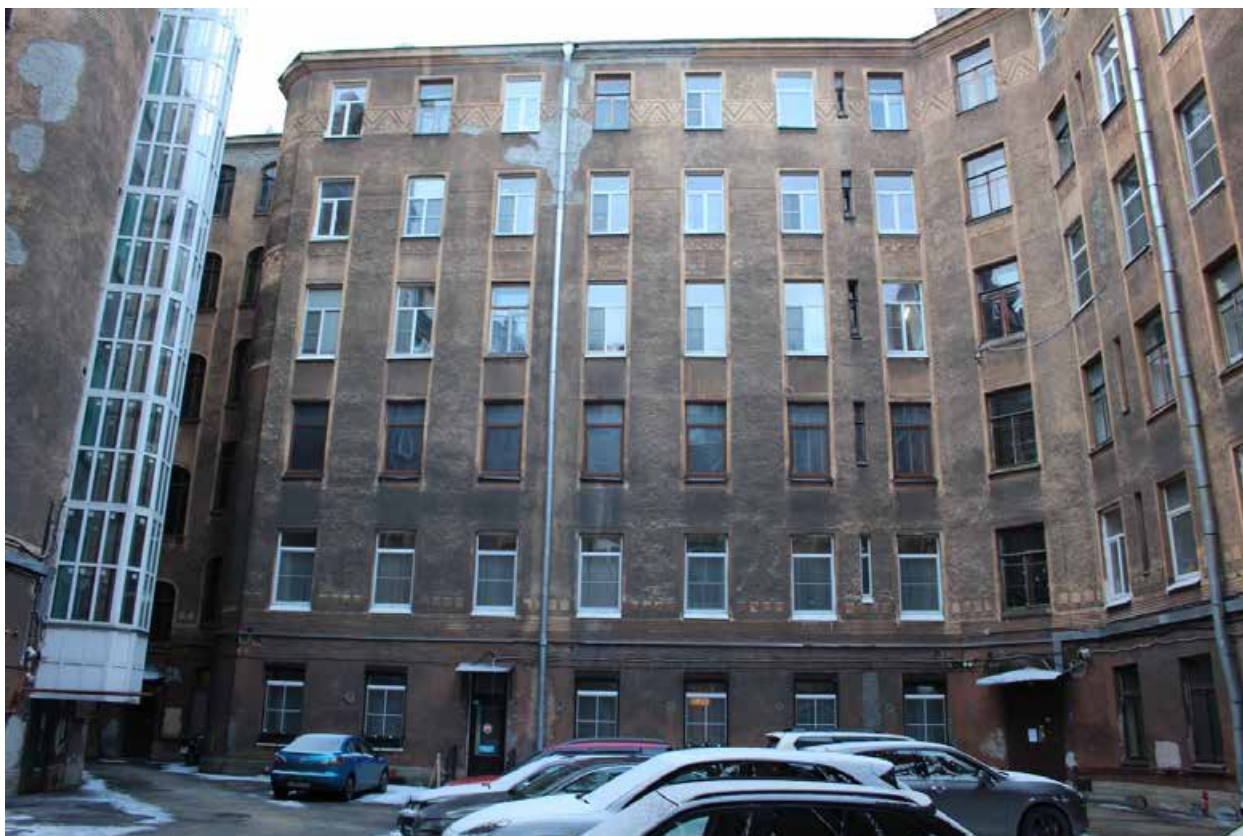
Фото 21. Вид на южный дворовый фасад объекта культурного наследия регионального значения «Дом Л.Л. Кенига».
