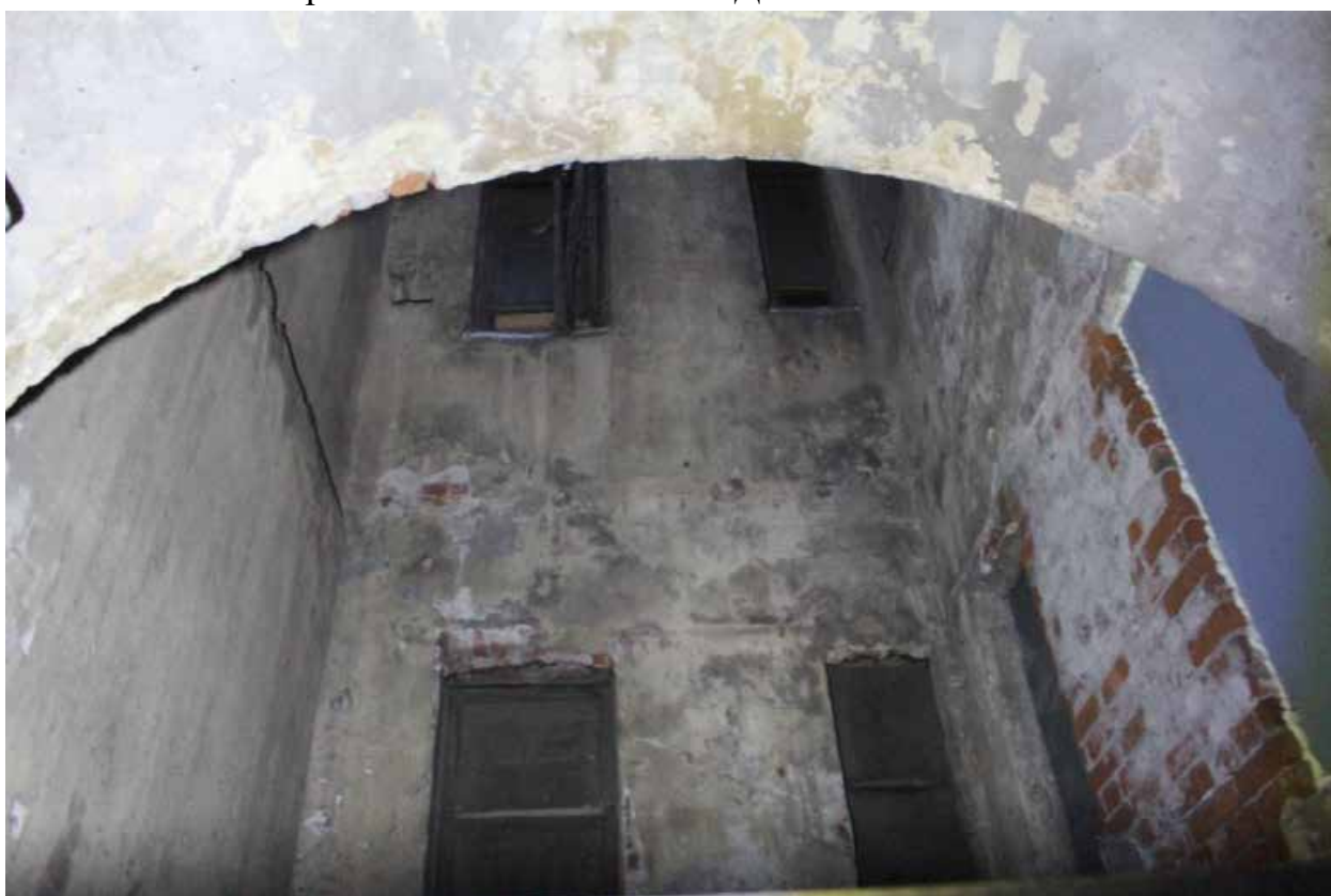
Фото 14. Фрагмент замкнутого двора в арке воротного проезда объекта культурного наследия регионального значения «Дом Л.Л. Кенига».
