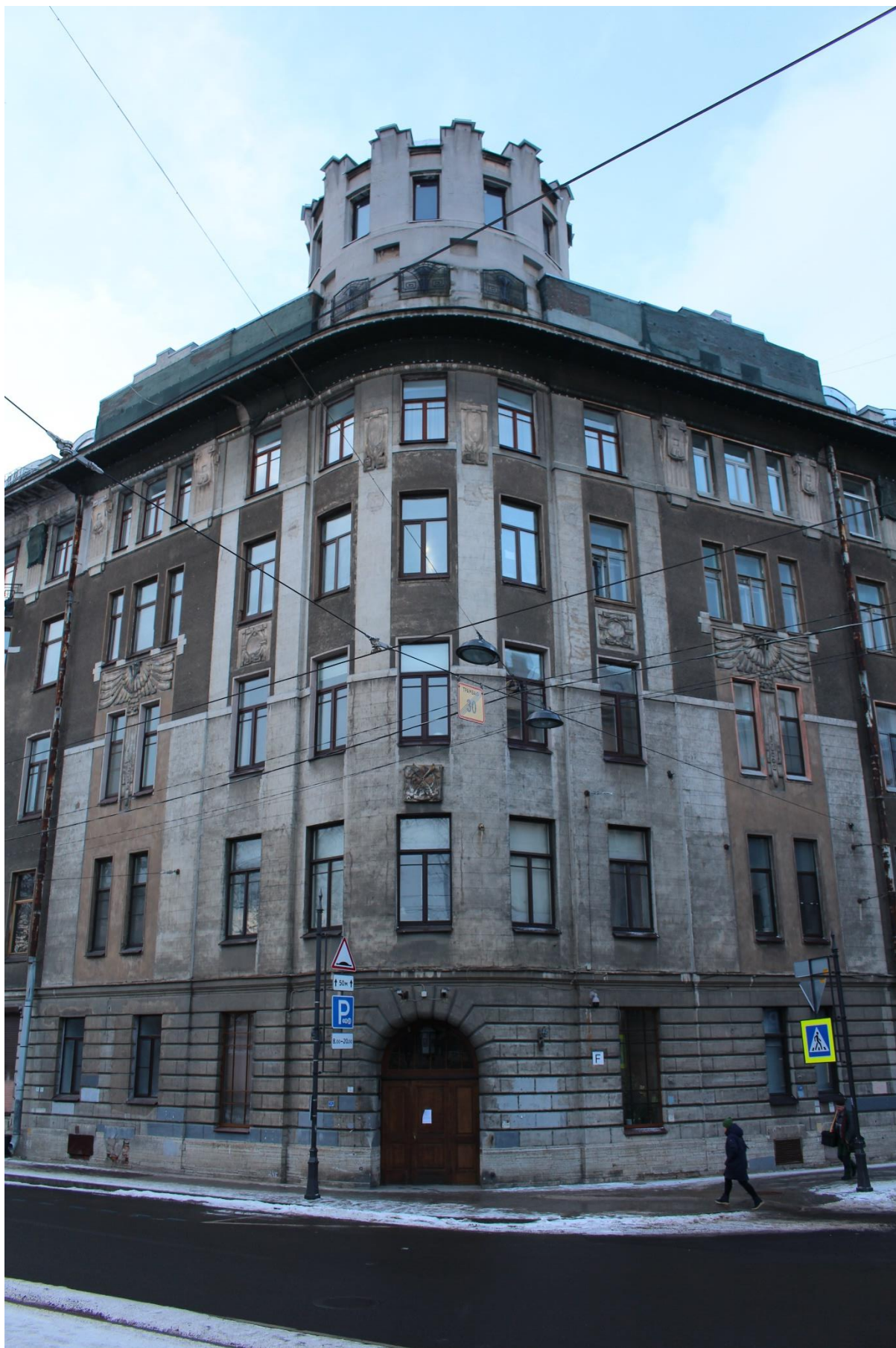
Фото 6. Вид угловую часть лицевых фасадов объекта культурного наследия регионального значения «Дом Л.Л. Кенига» на пересечении улицы Блохина и Кронверкского проспекта.
