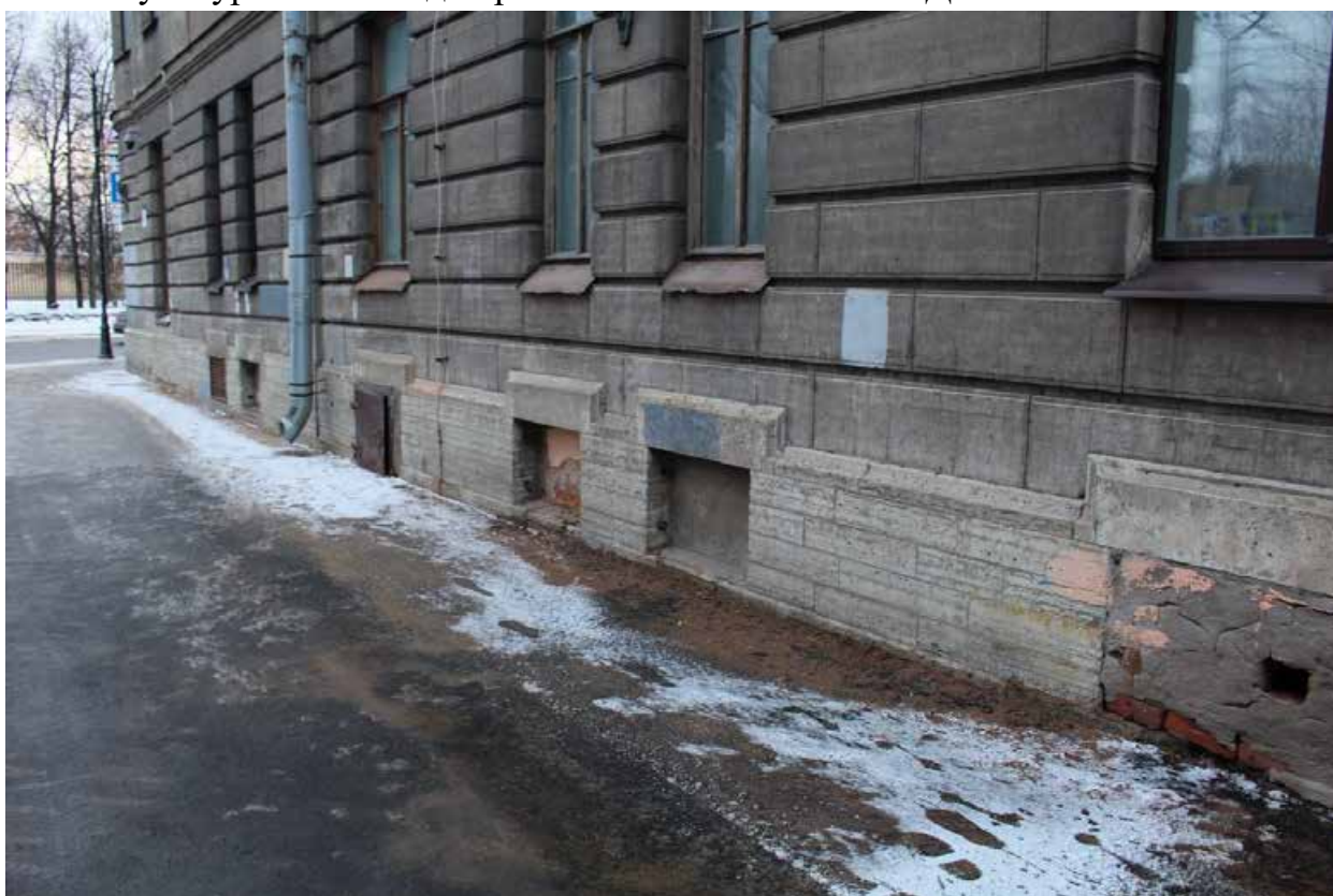
Фото 10. Вид на северный лицевой фасад (по улице Блохина) объекта культурного наследия регионального значения «Дом Л.Л. Кенига» в уровне 1-го этажа.
