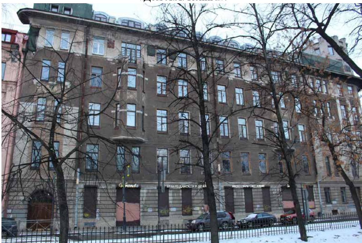
Фото 2. Вид на восточный лицевой фасад (по Кронверкскому проспекту) объекта культурного наследия регионального значения «Дом Л.Л. Кенига».
