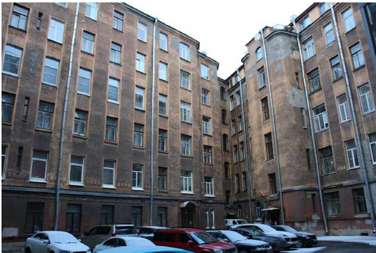
Фото 26. Вид на западный и северный дворовые фасады объекта культурного наследия регионального значения «Дом Л.Л. Кенига».
