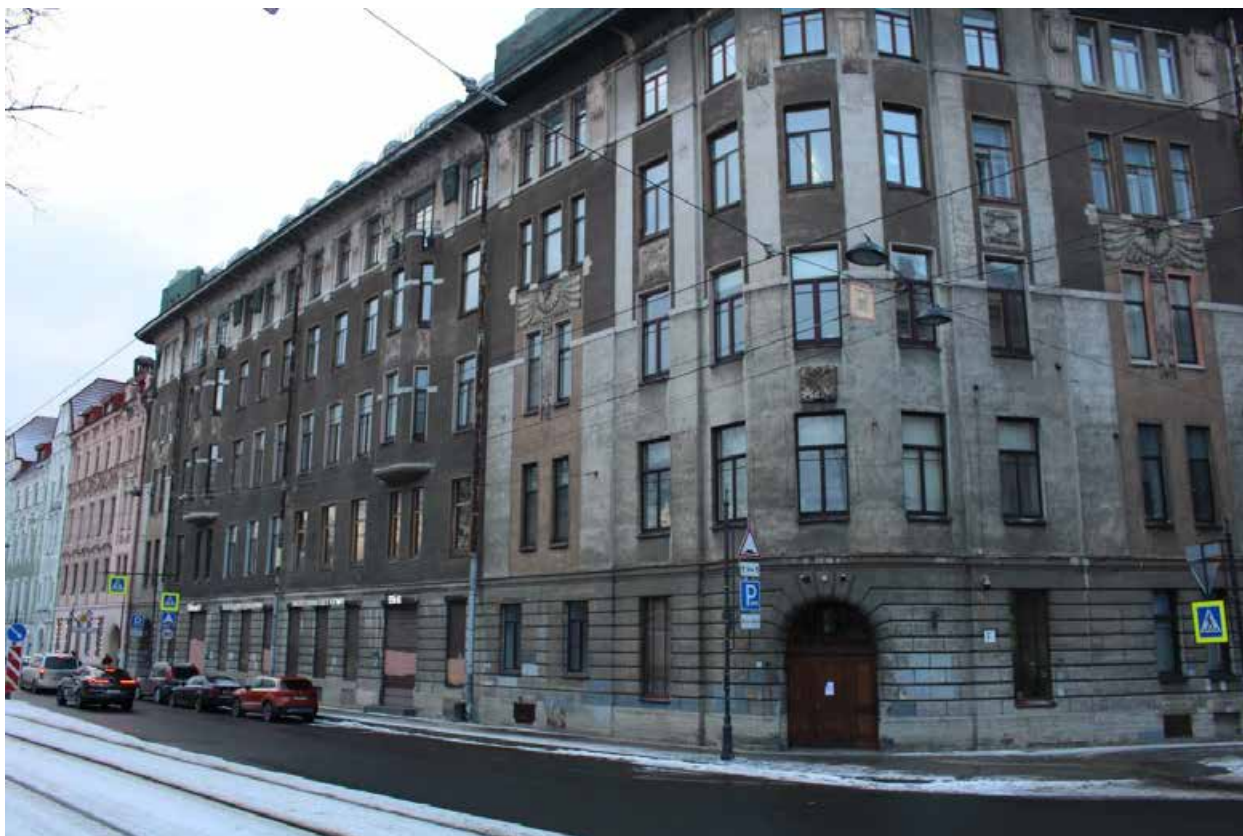
Фото 5. Вид на восточный лицевой фасад (по Кронверкскому проспекту) объекта культурного наследия регионального значения «Дом Л.Л. Кенига».
