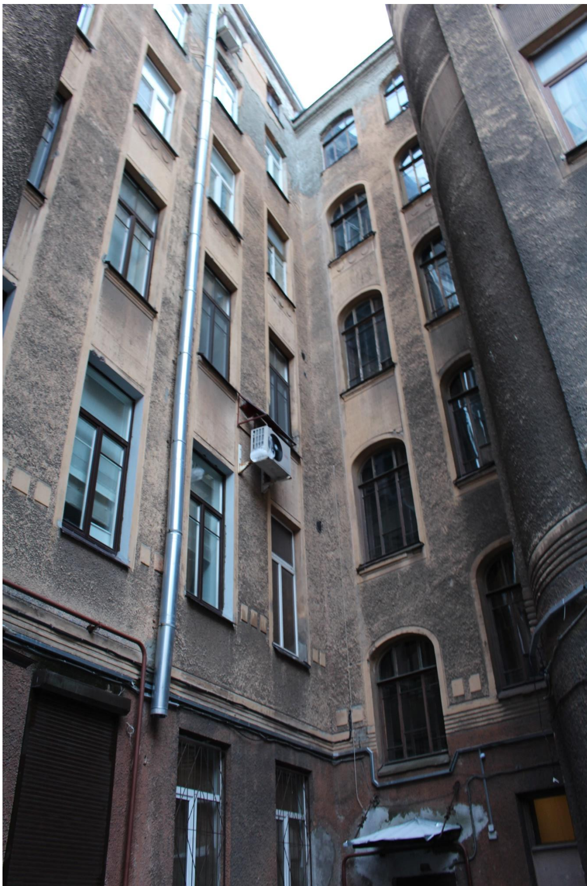
Фото 25. Вид на юго-восточный угол объекта культурного наследия регионального значения «Дом Л.Л. Кенига» со стороны двора.
