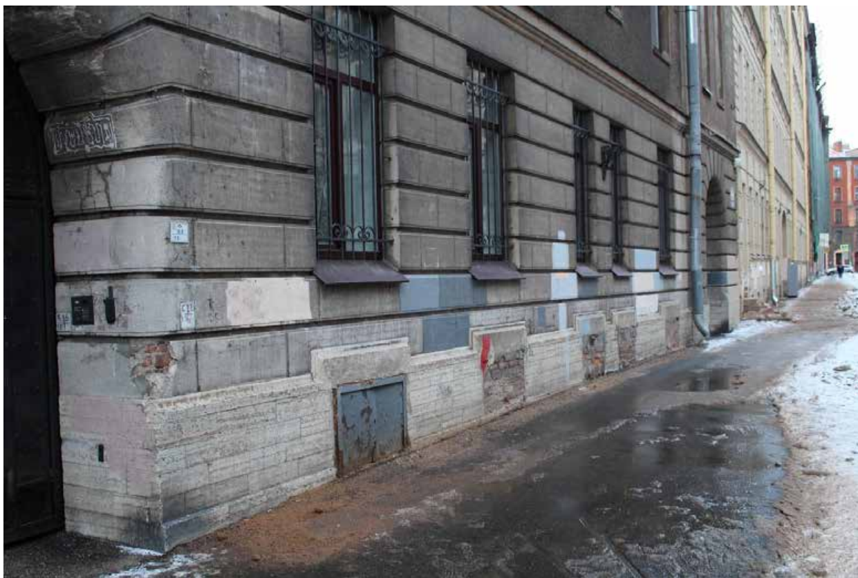
Фото 11. Вид на северный лицевой фасад (по улице Блохина) объекта культурного наследия регионального значения «Дом Л.Л. Кенига» в уровне 1-го этажа.
