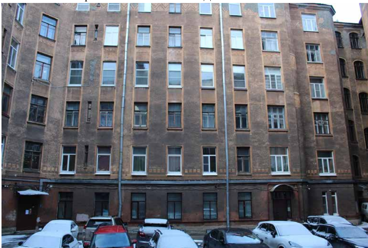
Фото 20. Вид на западный дворовый фасад объекта культурного наследия регионального значения «Дом Л.Л. Кенига».
