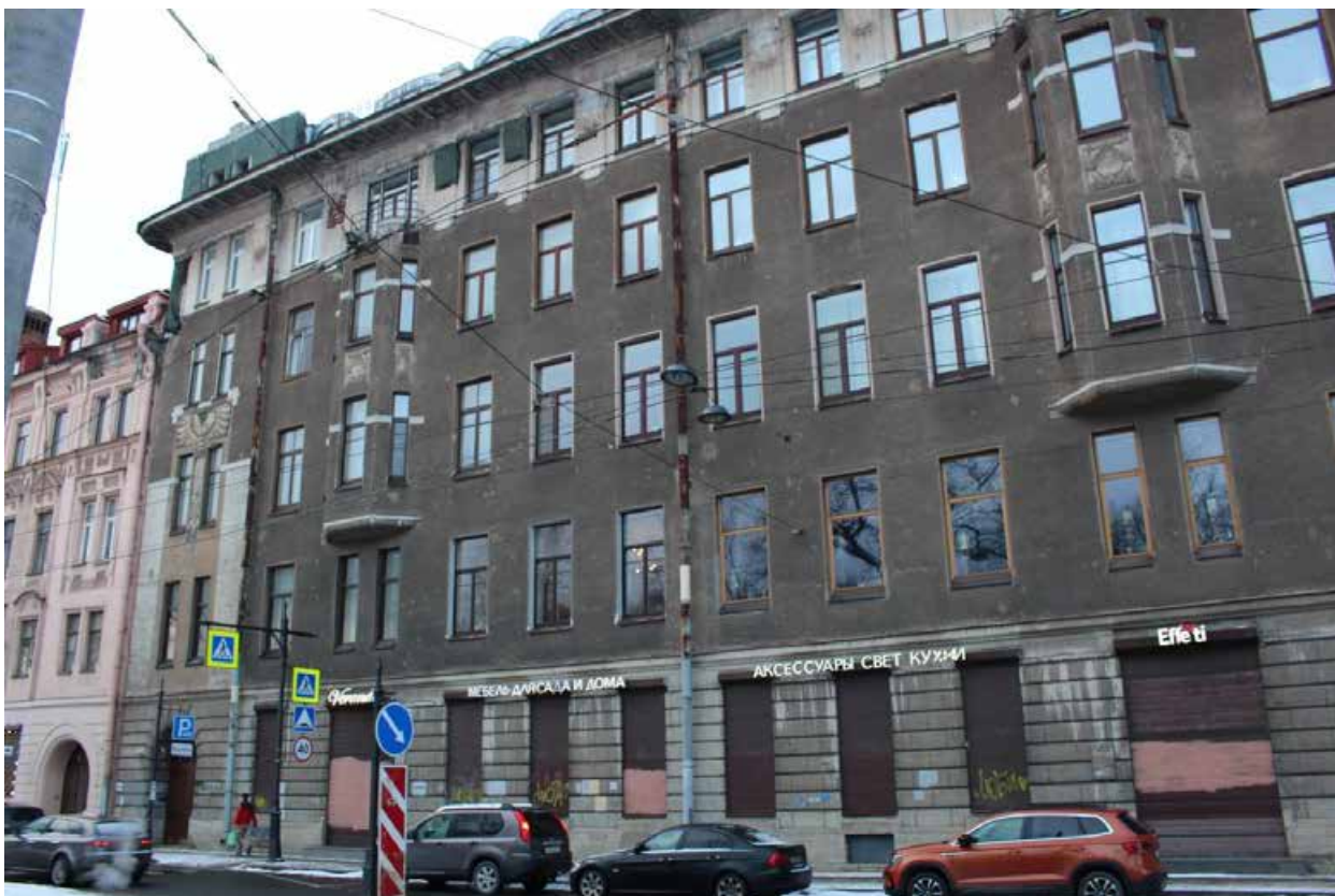
Фото 3. Вид на восточный лицевой фасад (по Кронверкскому проспекту) объекта культурного наследия регионального значения «Дом Л.Л. Кенига».
