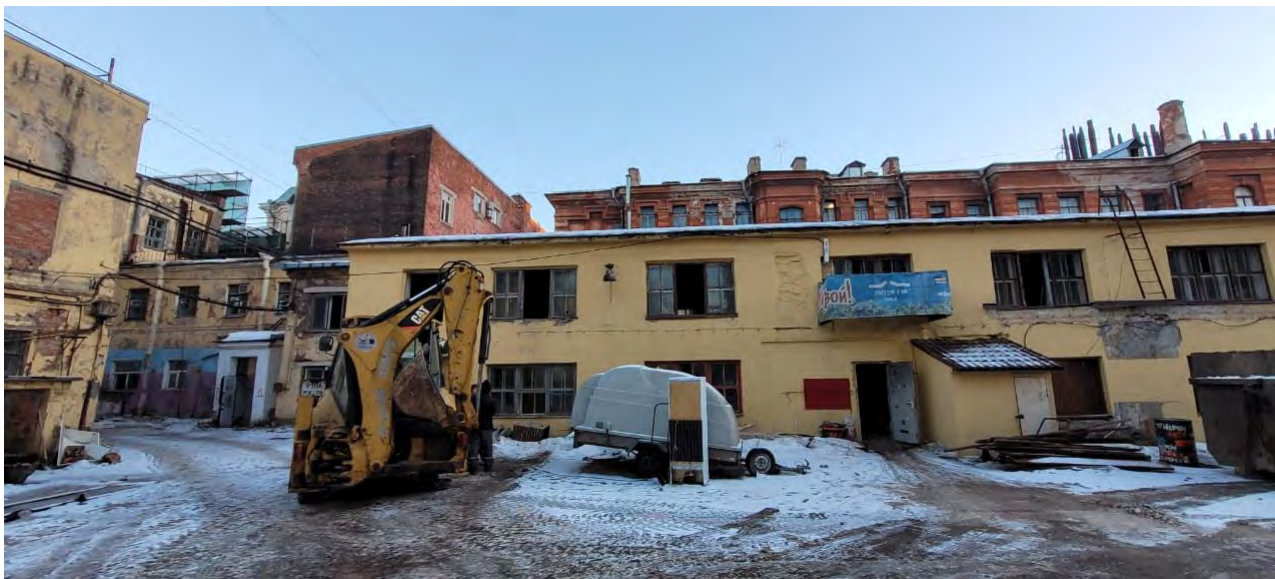
Фото 8. Общий вид со стороны двора: слева на переднем плане - реконструируемое здание 1 (Биржевая линия, д. 8-10, лит. А); на заднем плане – здание 5 - выявленный объект культурного наследия «Здание студенческой столовой Санкт-Петербургского университета» (Биржевая линия, д. 6, лит. А); по центру на переднем плане – реконструируемое здание 2 (Биржевая линия, д. 12, лит. Е); на заднем плане – здание 4 - объект культурного наследия регионального значения «Здание Химической лаборатории» (Университетская наб., д. 7-9-11, лит. Ц). Фото от 30.01.2024 г.
