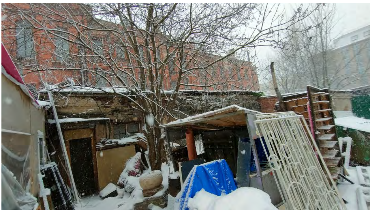
Фото 15. Вид со стороны двора: на переднем плане - реконструируемое здание 3 (Биржевая линия, д. 12, лит. О); на заднем плане – здание 4 - объект культурного наследия регионального значения «Здание Химической лаборатории» (Университетская наб., д. 7-9-11, лит. Ц).
