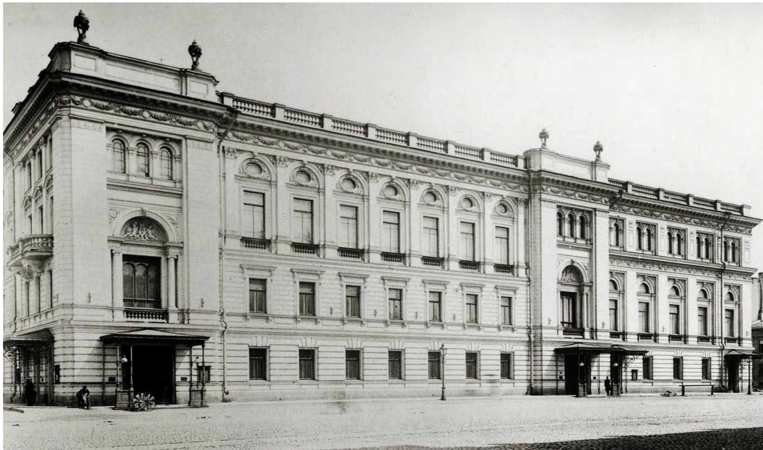
Ил. 9 8. Петербургская консерватория (Театральная пл., 3). Внешний вид здания консерватории. /Западный фасад./ (до 1914 г.) Автор съемки неизвестен. ЦГА КФФД. В 2990.
