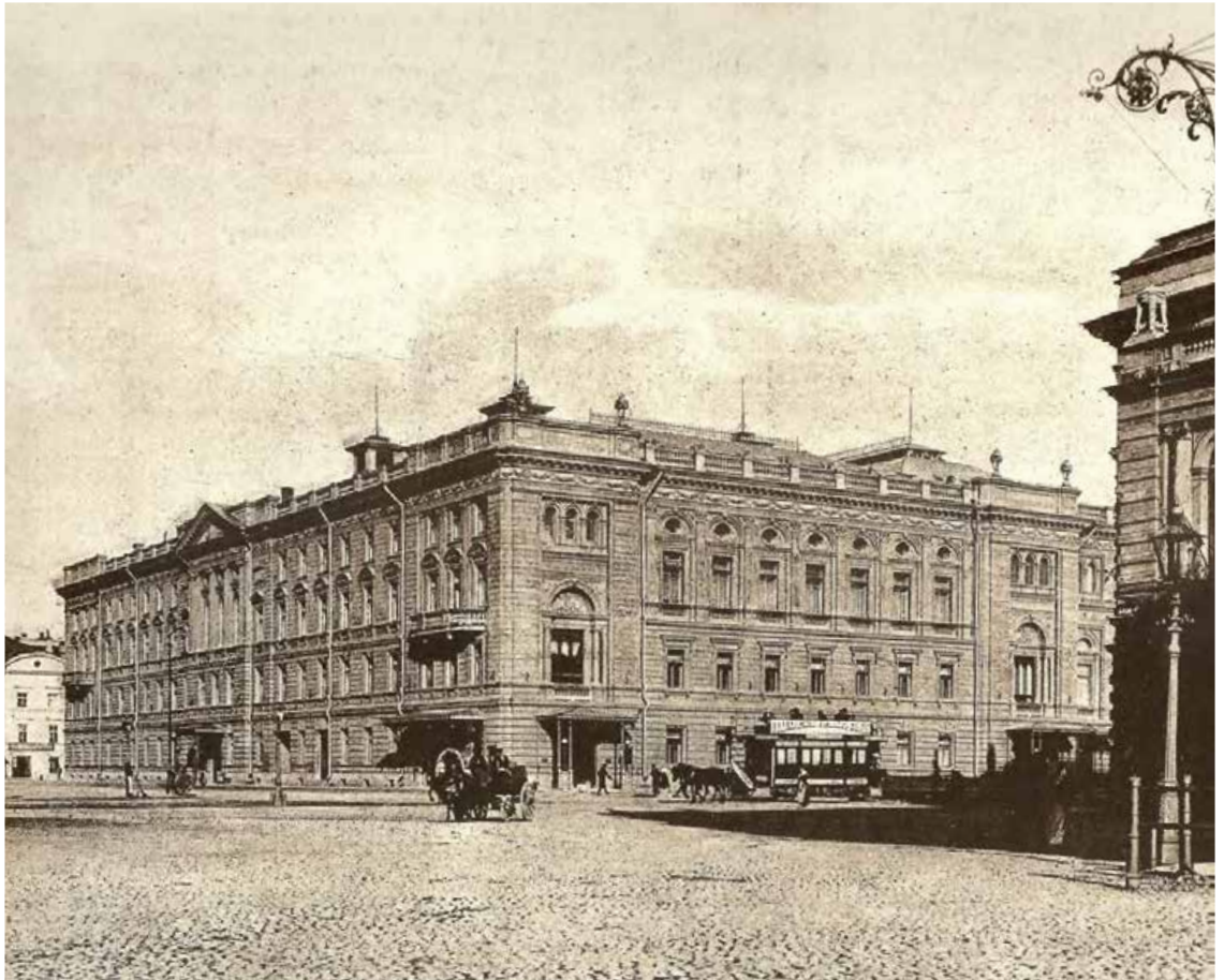
Ил. 9 4. Здание Консерватории Императорского Русского Музыкального Общества в С.-Петербурге. (перестр. в 1891-96 г. из бывш. Большого театра). Общий вид. (Между 1896 и 1908 гг.) Гражд. Инж. В.В. Николая. Опубл.: Барановский Г. В. Архитектурная энциклопедия второй половины XIX века. Том. II. (А-В). Общественные здания. Книга первая. М., 2006. С. 213.
