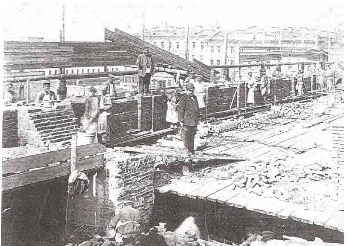
Ил. 9 2. Строительство здания Консерватории. Фото. Начало 1890-х гг. Опубл.: Санкт-Петербургская консерватория. Документы и материалы из фондов Библиотеки и Музея. Т. 1. СПб, 2002. С. 100.
