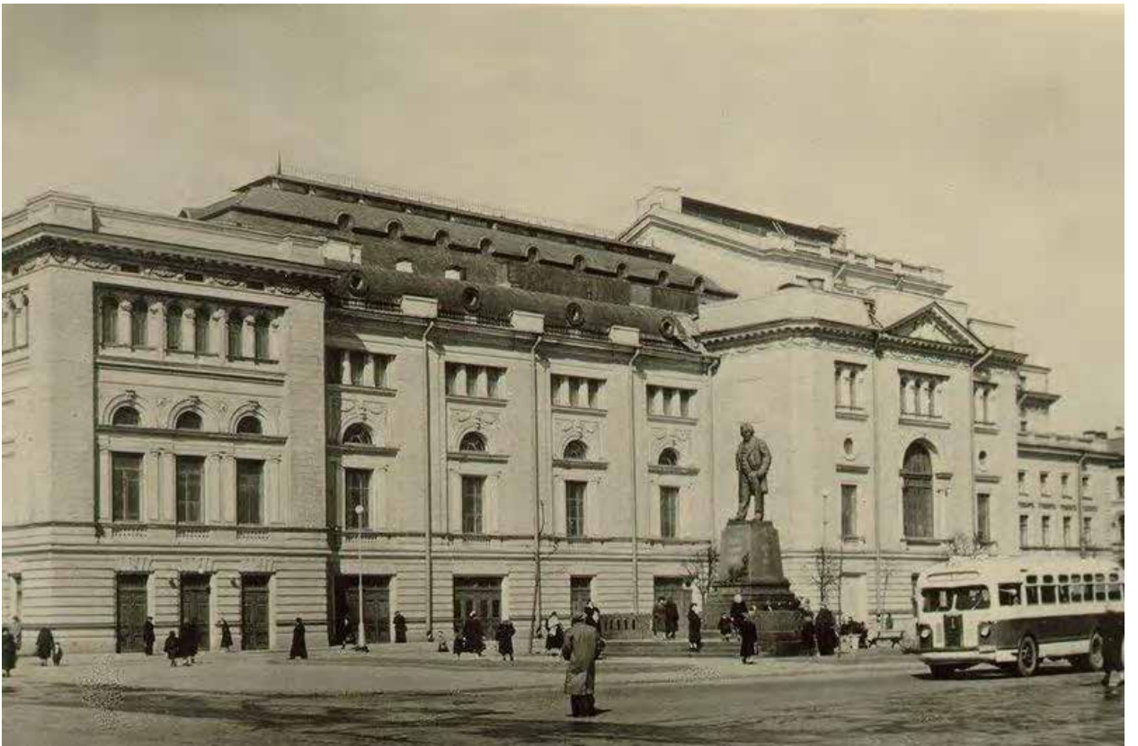
114. Фото 1953 г. Здание Консерватории. Южный фасад.
