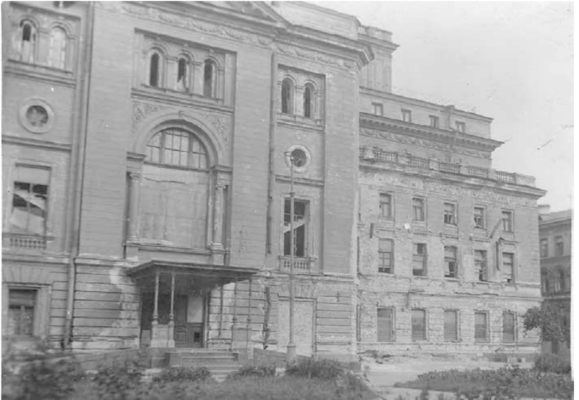
Ил. 10 5. Часть главного фасада здания Ленинградской государственной консерватории имени Н.А. Римского-Корсакова (Театральная пл., 3), поврежденного артиллерийским обстрелом.
