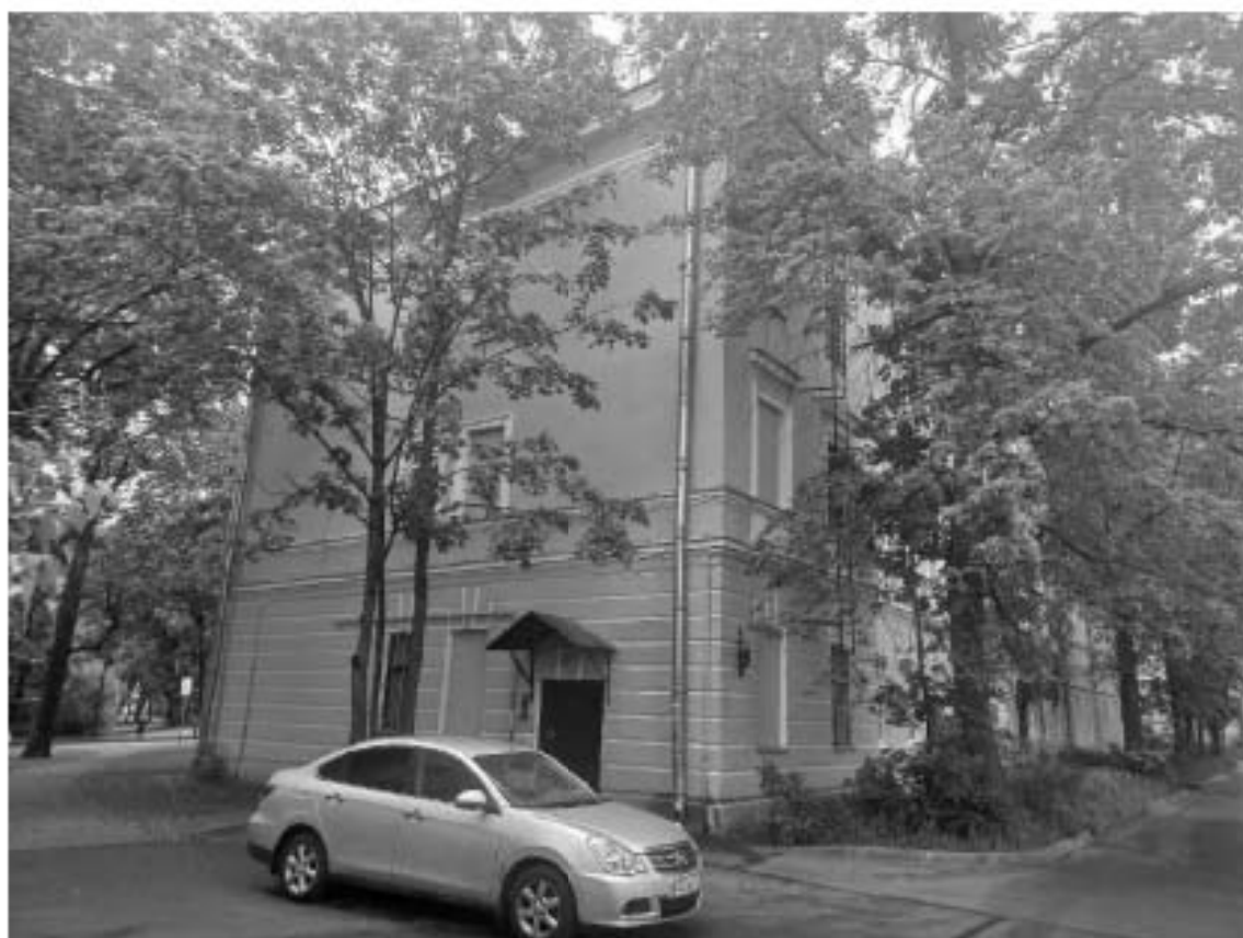
Фото 19. «Казармы Собственного Его Императорского Величества Пехотного полка» - «Семь зданий казарм», Дворцовая ул., д. 8
