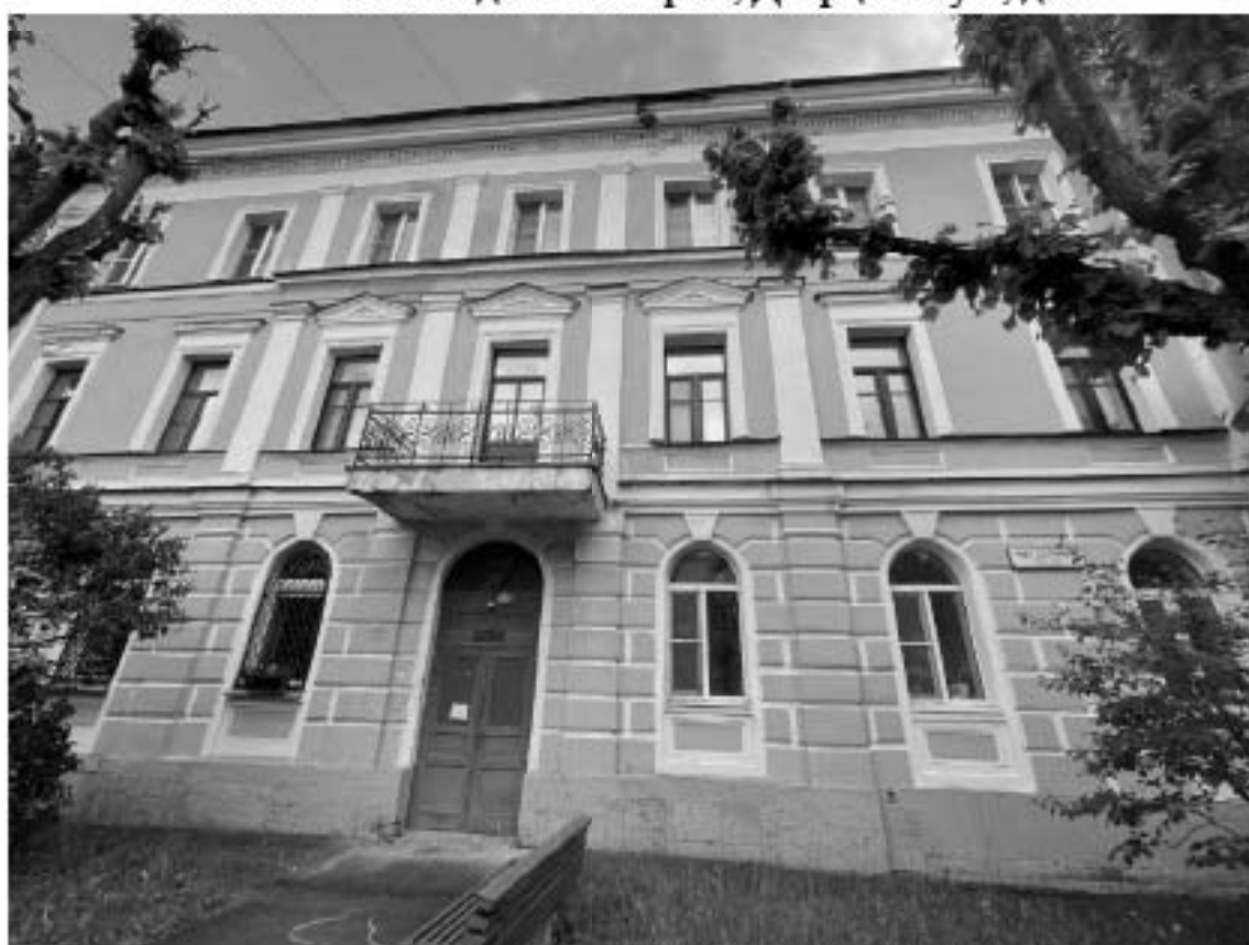
Фото 18. «Казармы Собственного Его Императорского Величества Пехотного полка» - «Семь зданий казарм», Дворцовая ул., д. 8
