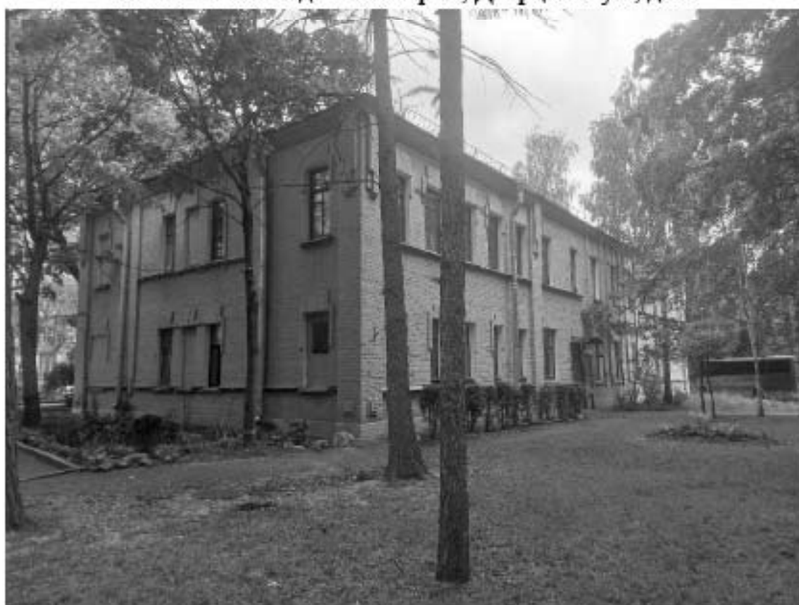
Фото 14. «Казармы Собственного Его Императорского Величества Пехотного полка» - «Семь зданий казарм», Дворцовая ул., д. 12
