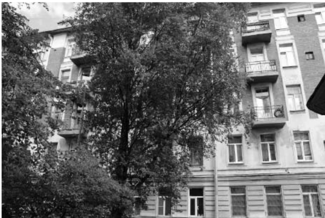
Фото 15. Вид на южный фасад объекта культурного наследия регионального значения «Жилой корпус» по адресу: Санкт-Петербург, Гаванская улица, дом 47, литера Б.
