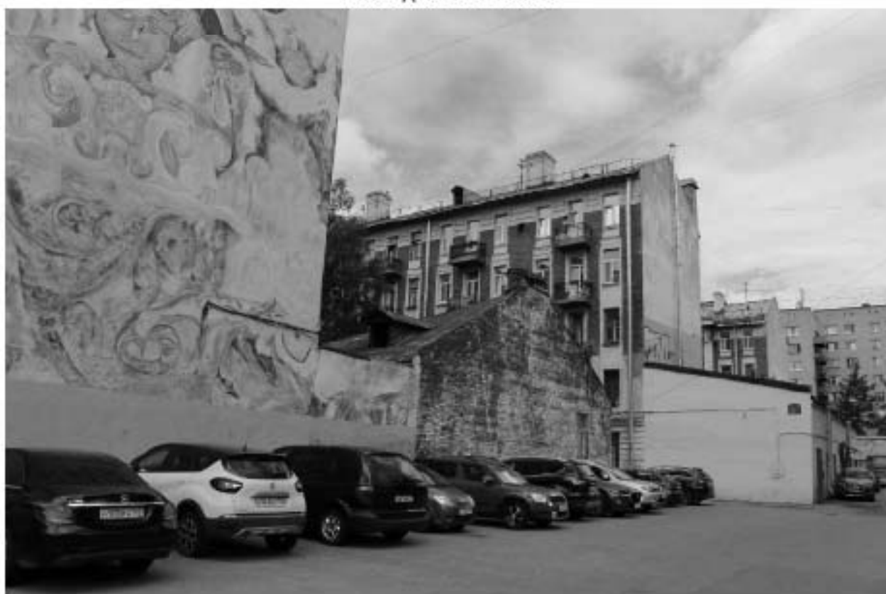
Фото 50. Вид на восточные фасады объектов культурного наследия «Жилой корпус» (литеры А, Б, В).
