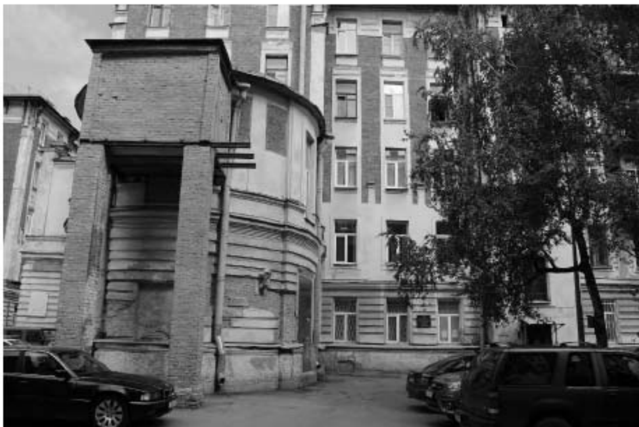
Фото 21. Вид на южный фасад объекта культурного наследия регионального значения «Жилой корпус» по адресу: Санкт-Петербург, Гаванская улица, дом 47, литера Б.
