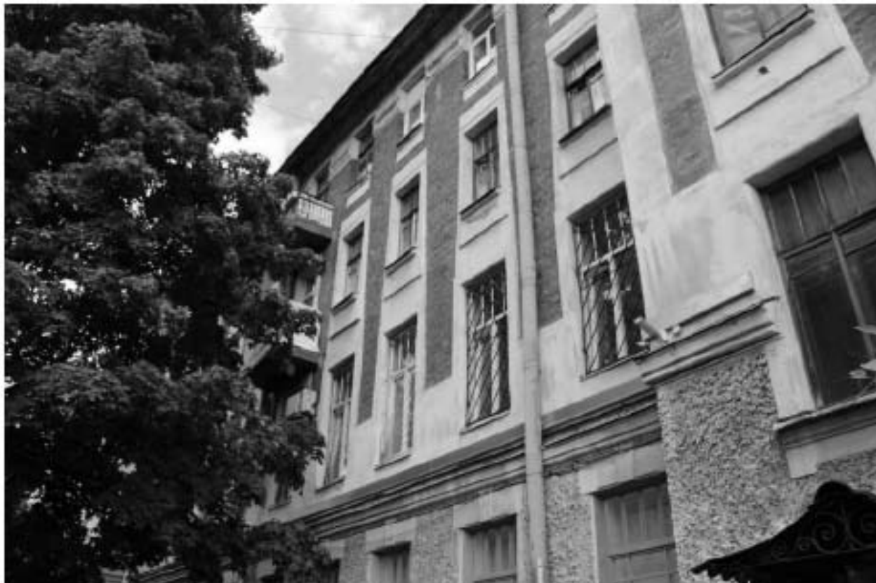
Фото 42. Вид на южный фасад объекта культурного наследия регионального значения «Жилой корпус» по адресу: Санкт-Петербург, Гаванская улица, дом 47, литера В.
