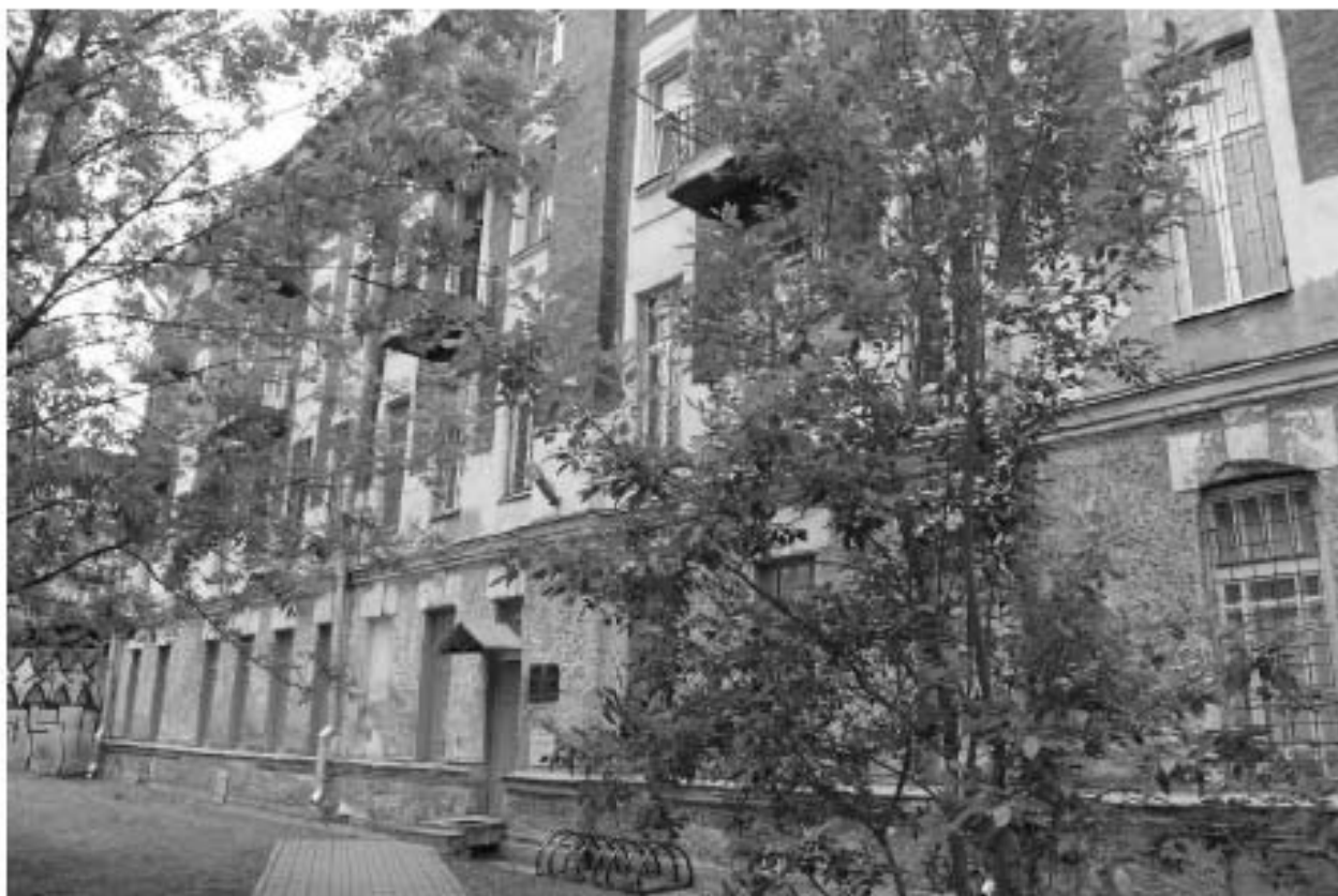
Фото 35. Вид на северный фасад объекта культурного наследия регионального значения «Жилой корпус» по адресу: Санкт-Петербург, Гаванская улица, дом 47, литера В.
