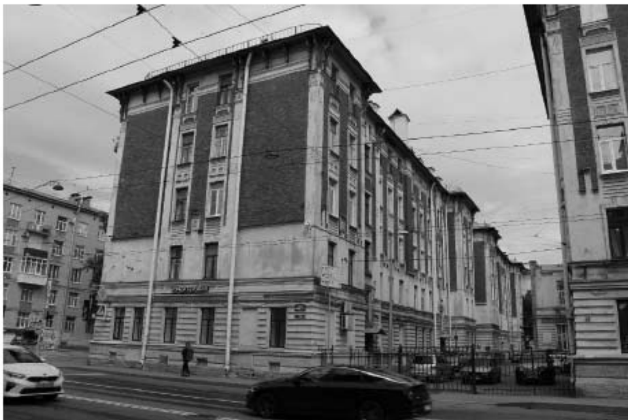
Фото 51. Вид на южный и восточный фасады объекта культурного наследия регионального значения «Жилой корпус» по адресу: Санкт-Петербург, Гаванская улица, дом 47, литера Г.
