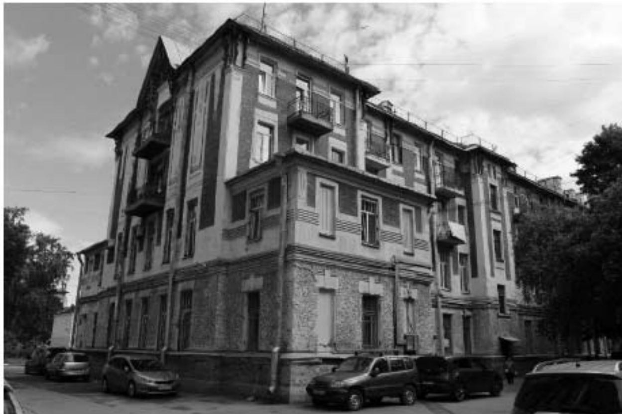
Фото 47. Вид на западный и южный фасады объекта культурного наследия регионального значения «Жилой корпус» по адресу: Санкт-Петербург, Гаванская улица, дом 47, литера В.
