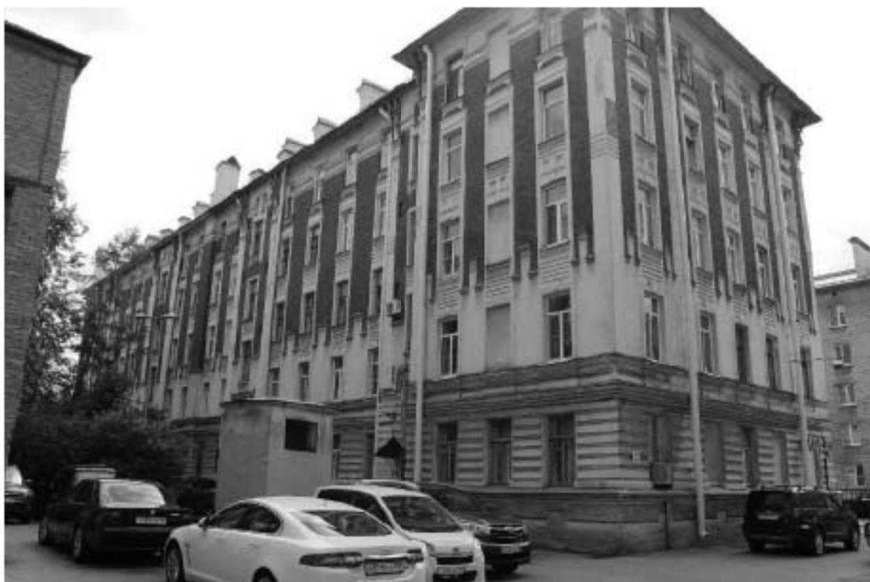
Фото 9. Вид на западный и северный фасады объекта культурного наследия регионального значения «Жилой корпус» по адресу: Санкт-Петербург, Гаванская улица, дом 47, литера А.
