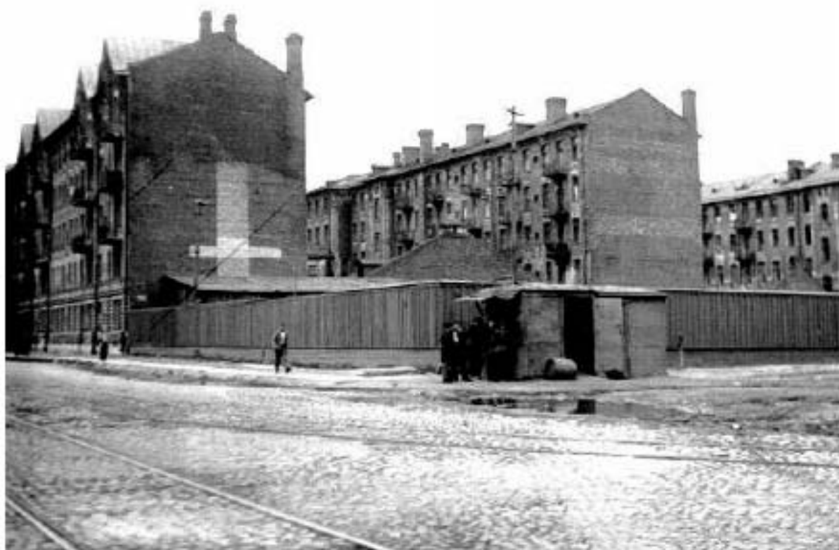
Илл. 106. Здания Гаванского рабочего городка со стороны Наличного переулка. 1939 г. (источник: https://pastvu.com/p/131832 ).
