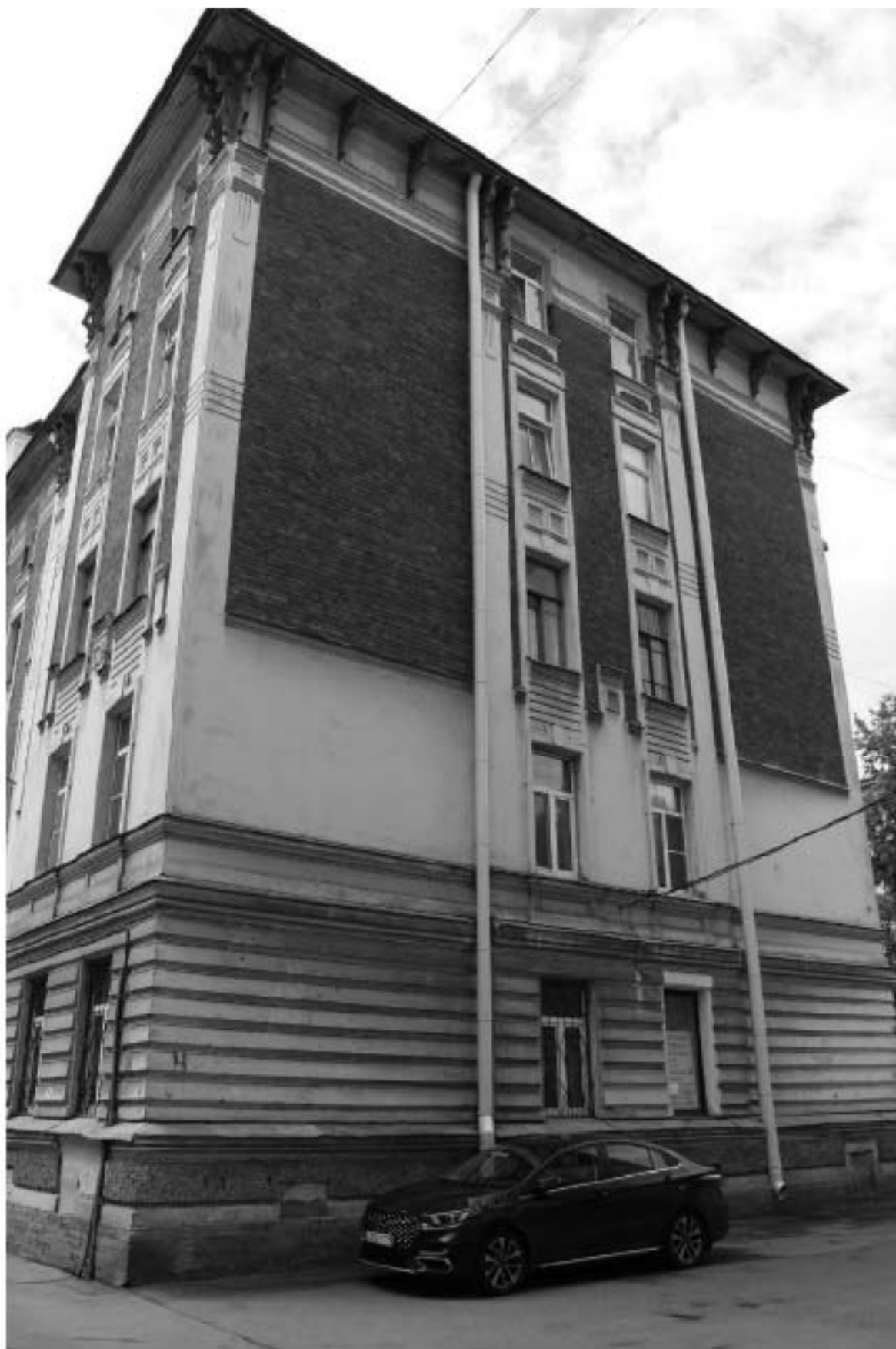
Фото 58. Вид на северный фасад объекта культурного наследия регионального значения «Жилой корпус» по адресу: Санкт-Петербург, Гаванская улица, дом 47, литера Г.
