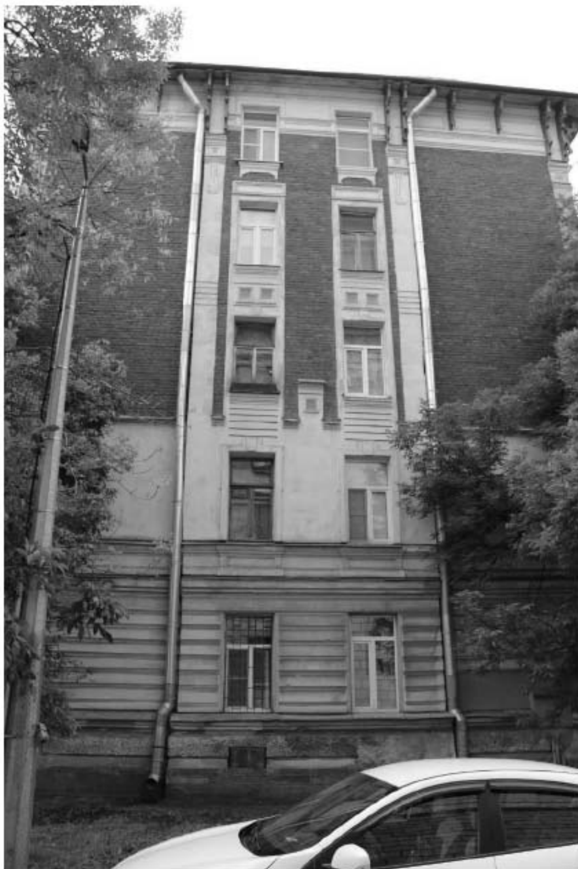
Фото 66. Вид на северный фасад объекта культурного наследия регионального значения «Жилой корпус» по адресу: Санкт-Петербург, Гаванская улица, дом 47, литера Д.
