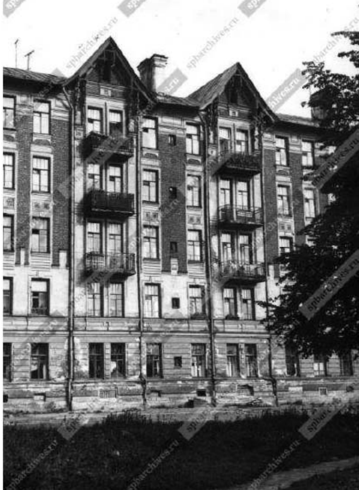
Илл. 108. Фрагмент фасада одного из разрушающихся жилых домов Жилого комплекса «Гаванский рабочий городок» (Гаванская ул., 47; Мальный пр., 69, 71). 1955-1960 гг. (источник: ЦГАКФФД СПб. Фотодокумент Бр 67526).
