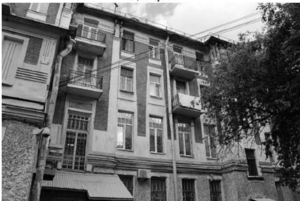
Фото 45. Вид на южный фасад объекта культурного наследия регионального значения «Жилой корпус» по адресу: Санкт-Петербург, Гаванская улица, дом 47, литера В.
