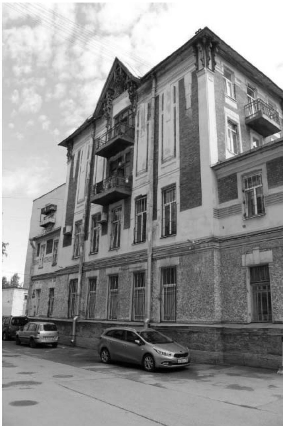
Фото 48. Вид на западный фасад объекта культурного наследия регионального значения «Жилой корпус» по адресу: Санкт-Петербург, Гаванская улица, дом 47, литера В.
