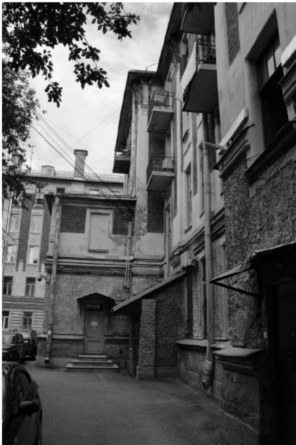
Фото 43. Вид на южный фасад объекта культурного наследия регионального значения «Жилой корпус» по адресу: Санкт-Петербург, Гаванская улица, дом 47, литера В.
