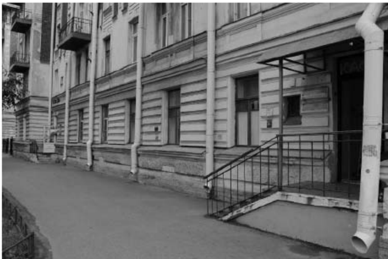
Фото 55. Вид на западный фасад объекта культурного наследия регионального значения «Жилой корпус» по адресу: Санкт-Петербург, Гаванская улица, дом 47, литера Г в уровне 1-го этажа.
