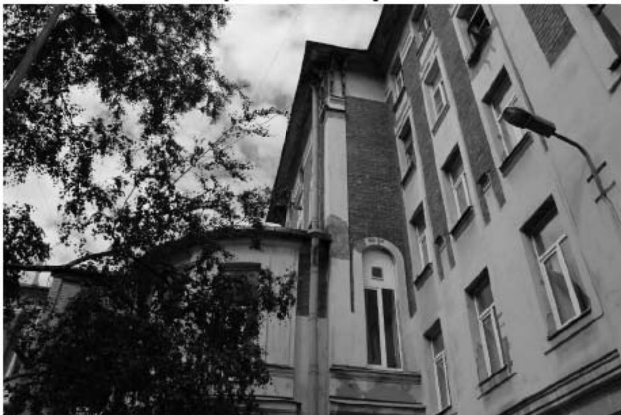
Фото 18. Вид на южный фасад объекта культурного наследия регионального значения «Жилой корпус» по адресу: Санкт-Петербург, Гаванская улица, дом 47, литера Б.
