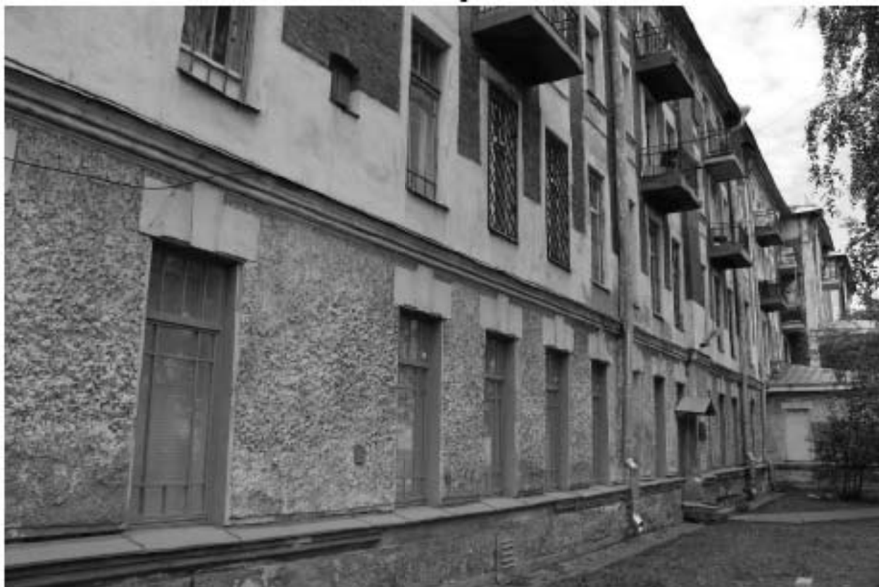
Фото 36. Вид на северный фасад объекта культурного наследия регионального значения «Жилой корпус» по адресу: Санкт-Петербург, Гаванская улица, дом 47, литера В.
