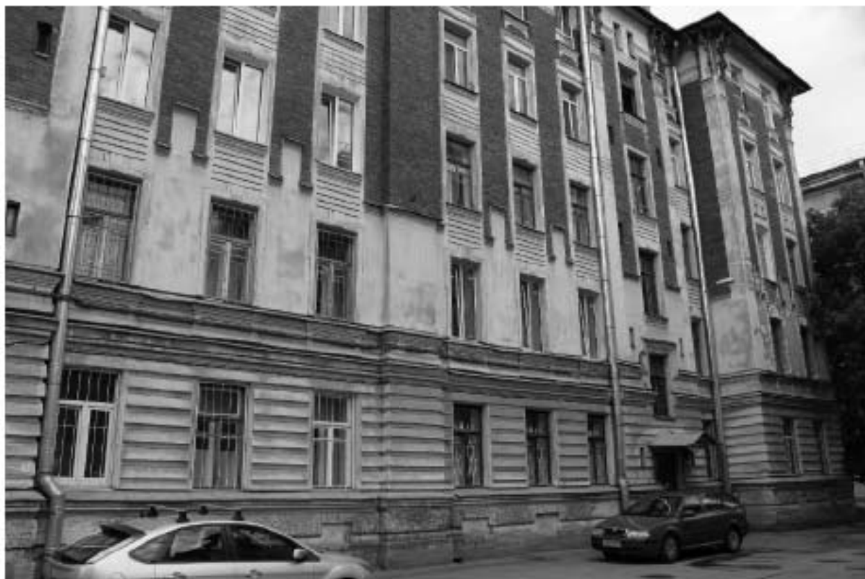
Фото 69. Вид на восточный фасад объекта культурного наследия регионального значения «Жилой корпус» по адресу: Санкт-Петербург, Гаванская улица, дом 47, литера Д.
