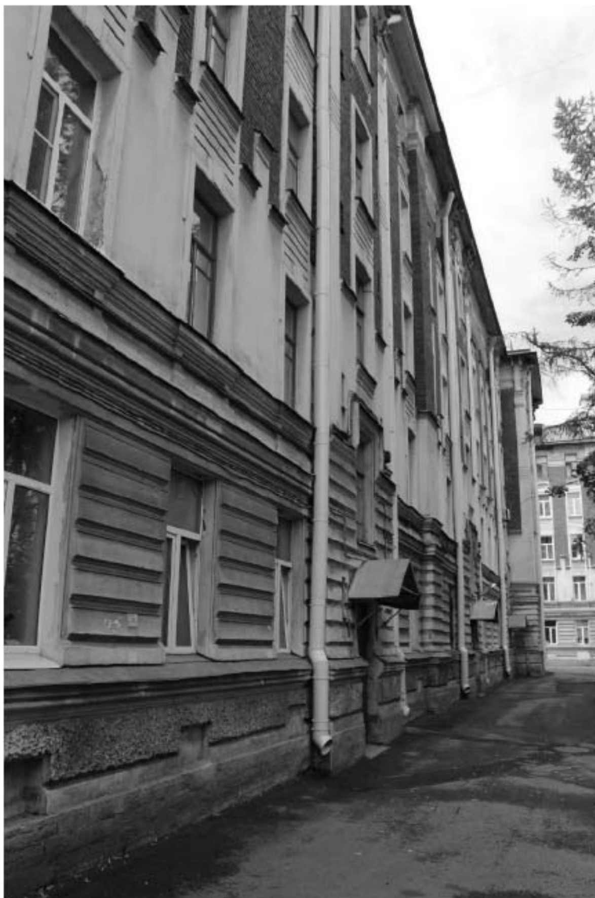
Фото 11. Вид на северный фасад объекта культурного наследия регионального значения «Жилой корпус» по адресу: Санкт-Петербург, Гаванская улица, дом 47, литера А.
