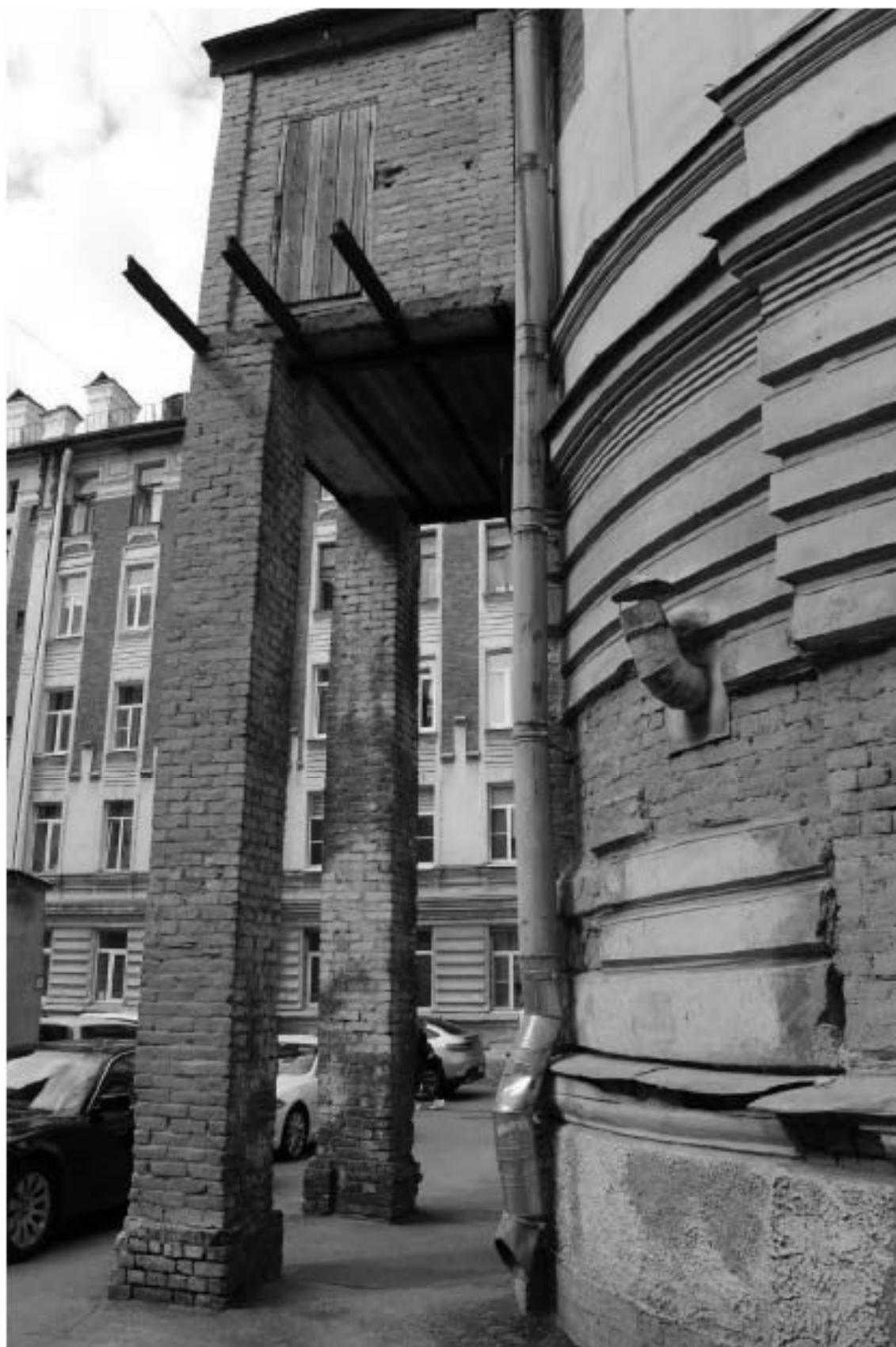
Фото 20. Вид на позднюю пристройку к двухэтажному ризалиту объекта культурного наследия регионального значения «Жилой корпус» по адресу: Санкт-Петербург, Гаванская улица, дом 47, литера Б.
