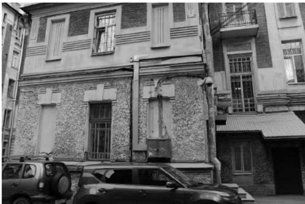
Фото 46. Вид на южный фасад объекта культурного наследия регионального значения «Жилой корпус» по адресу: Санкт-Петербург, Гаванская улица, дом 47, литера В.
