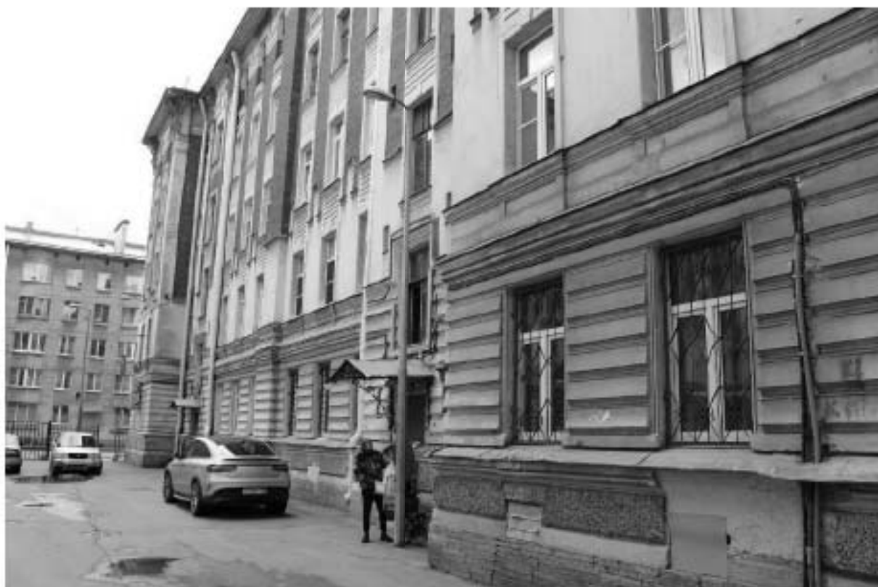
Фото 59. Вид на восточный фасад объекта культурного наследия регионального значения «Жилой корпус» по адресу: Санкт-Петербург, Гаванская улица, дом 47, литера Г.
