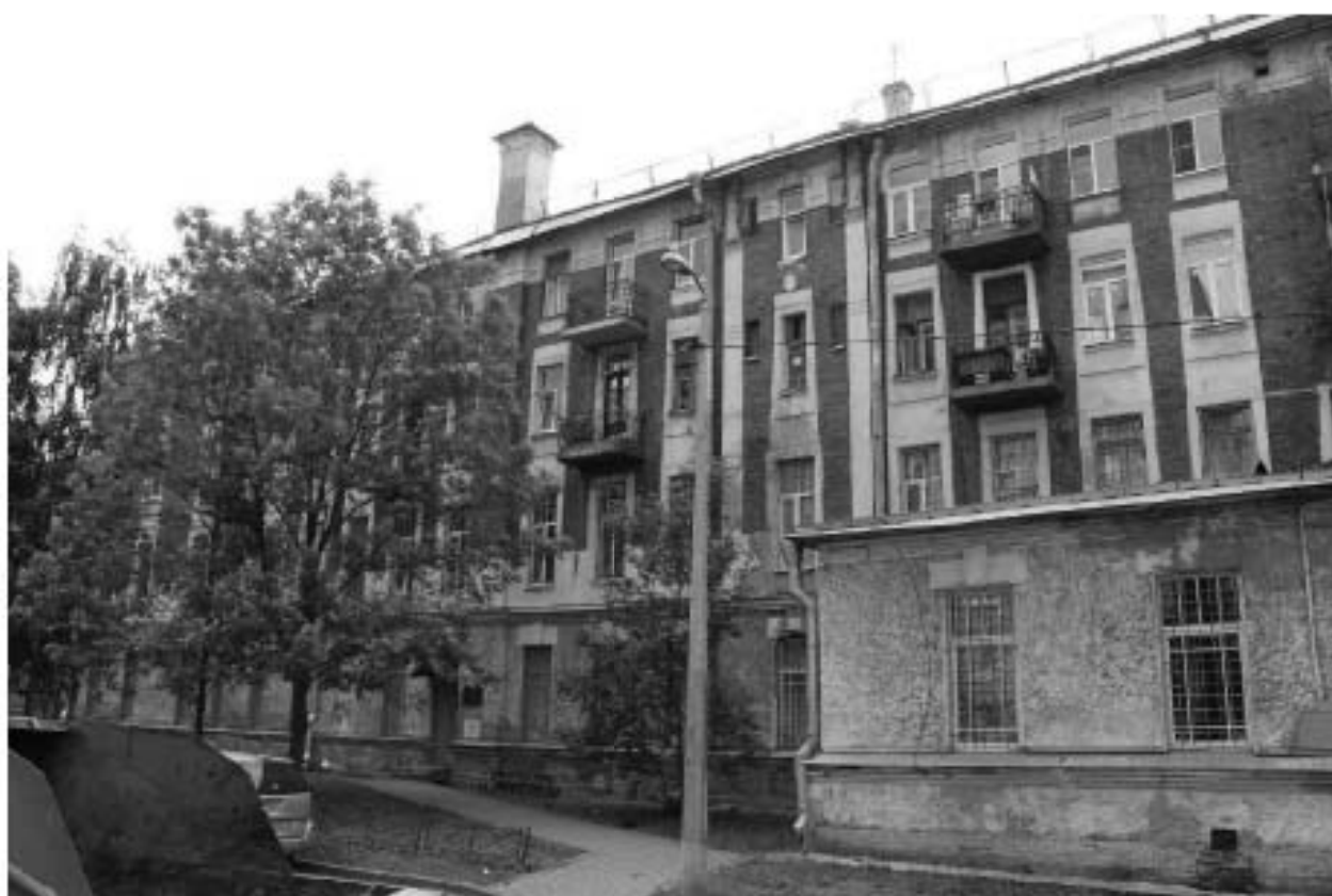
Фото 33. Вид на северный фасад объекта культурного наследия регионального значения «Жилой корпус» по адресу: Санкт-Петербург, Гаванская улица, дом 47, литера В.
