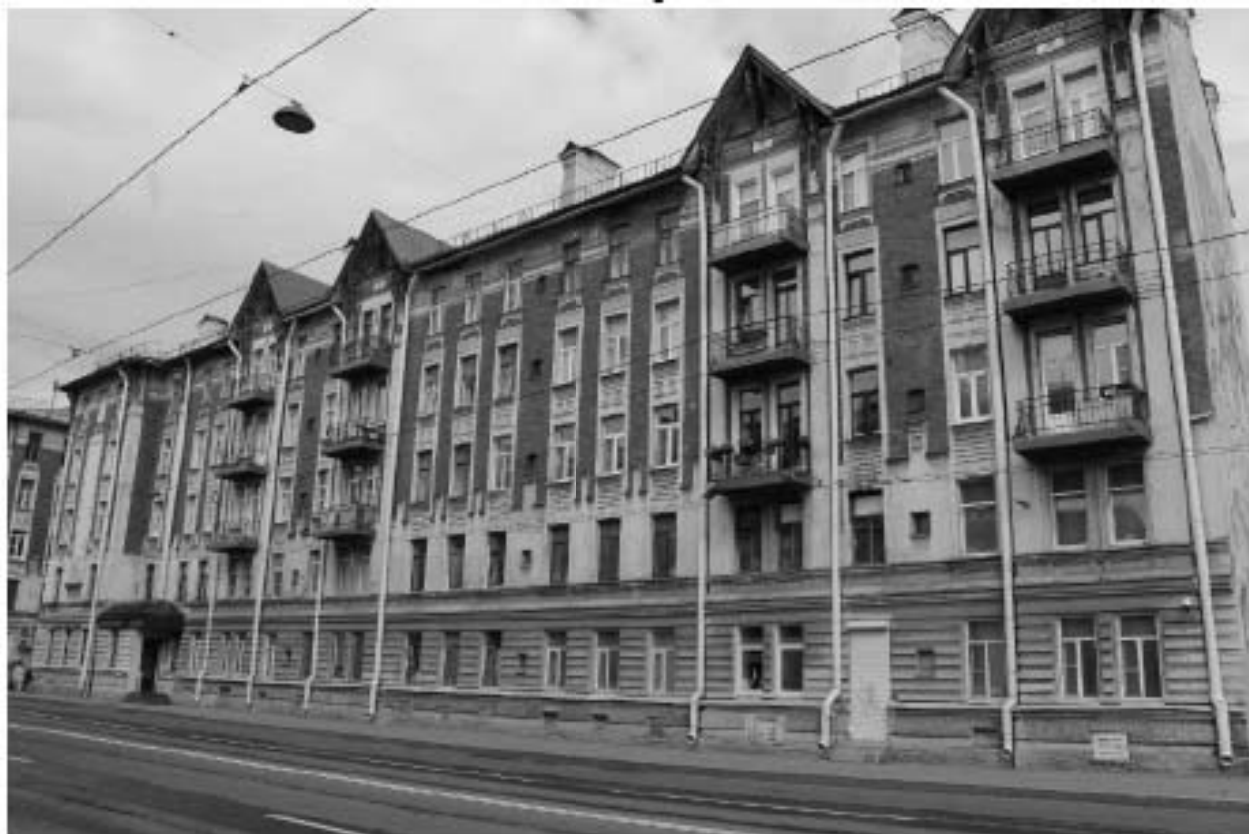
Фото 6. Вид на южный фасад объекта культурного наследия регионального значения «Жилой корпус» по адресу: Санкт-Петербург, Гаванская улица, дом 47, литера А.
