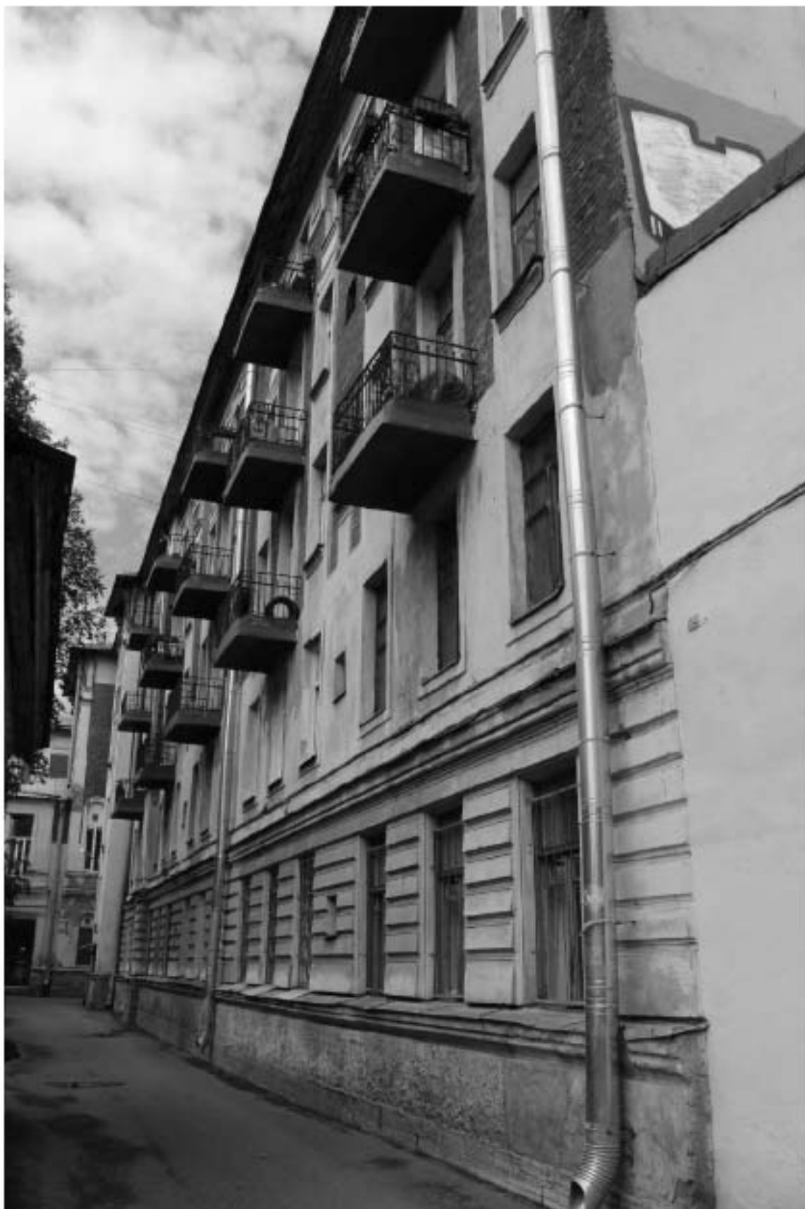
Фото 14. Вид на южный фасад объекта культурного наследия регионального значения «Жилой корпус» по адресу: Санкт-Петербург, Гаванская улица, дом 47, литера Б.
