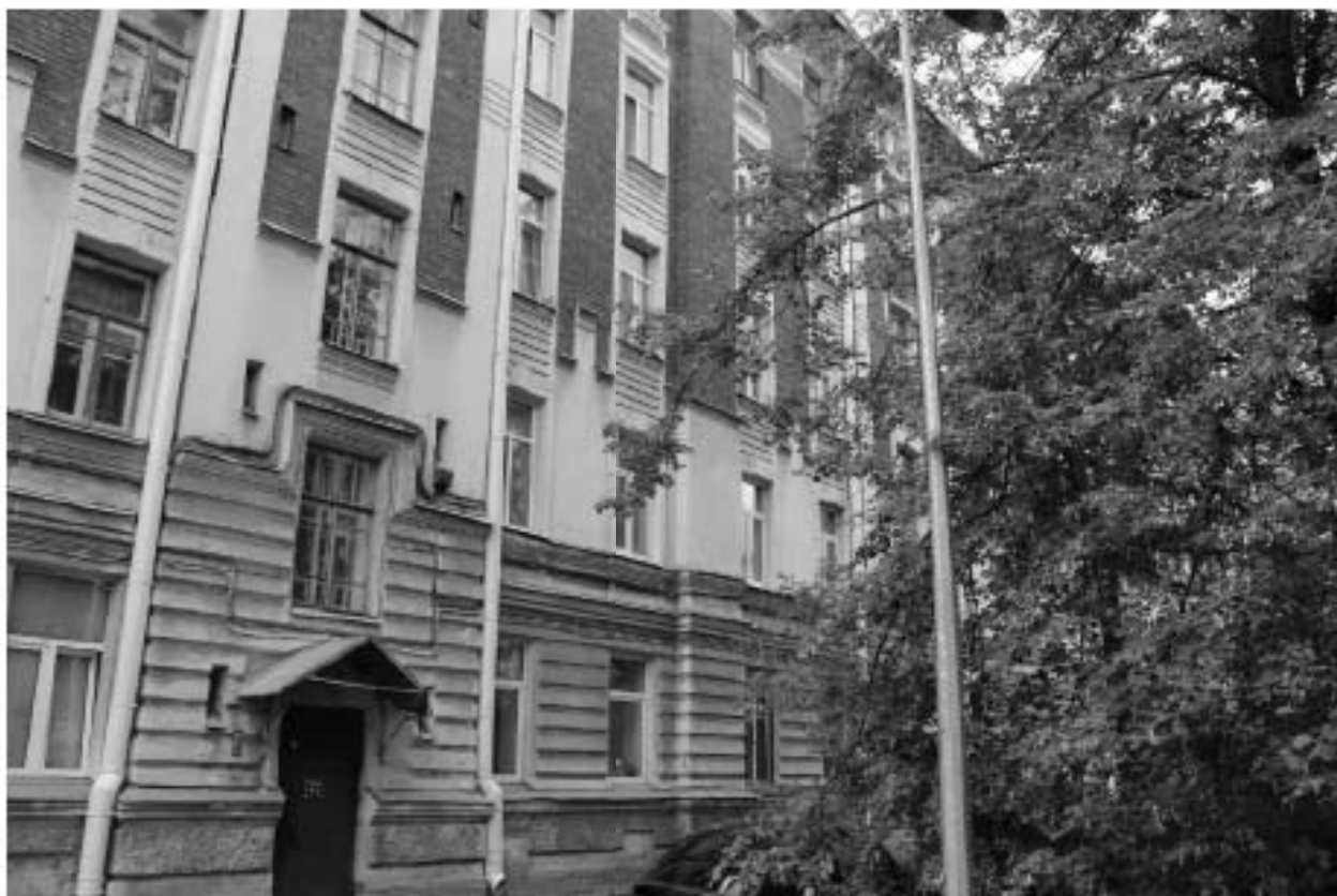
Фото 12. Вид на северный фасад объекта культурного наследия регионального значения «Жилой корпус» по адресу: Санкт-Петербург, Гаванская улица, дом 47, литера А.
