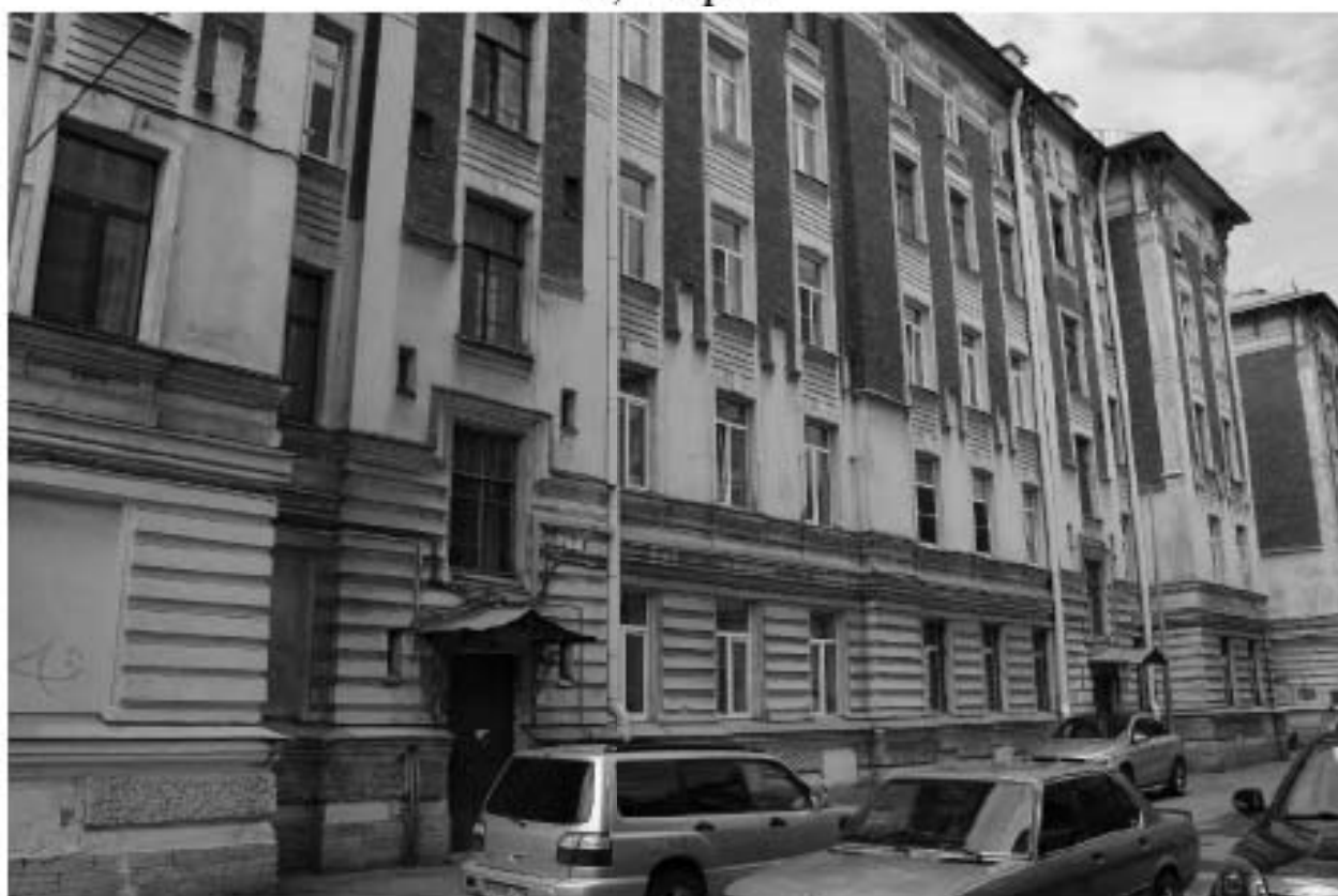
Фото 60. Вид на восточный фасад объекта культурного наследия регионального значения «Жилой корпус» по адресу: Санкт-Петербург, Гаванская улица, дом 47, литера Г.
