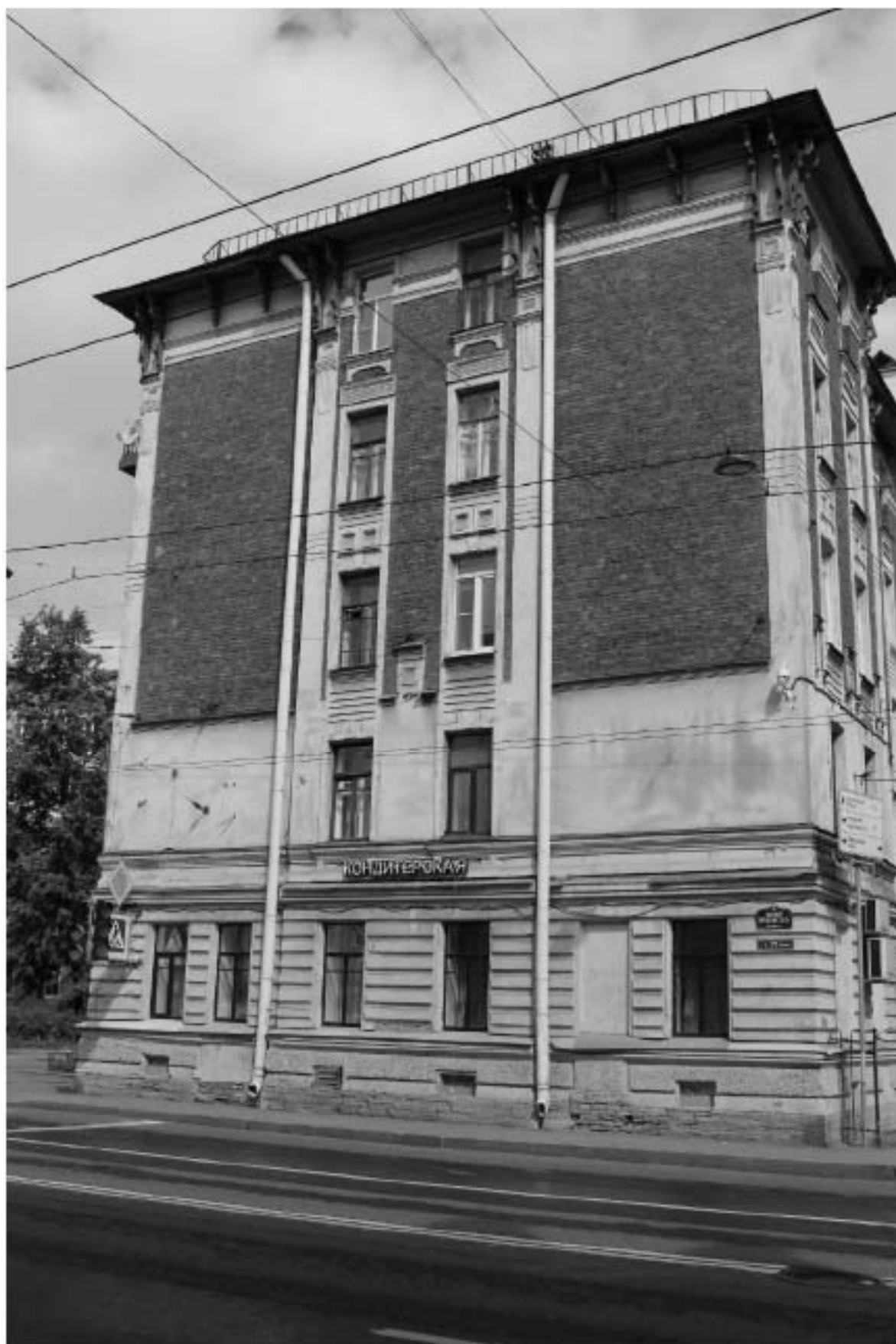
Фото 52. Вид на южный фасад объекта культурного наследия регионального значения «Жилой корпус» по адресу: Санкт-Петербург, Гаванская улица, дом 47, литера Г.
