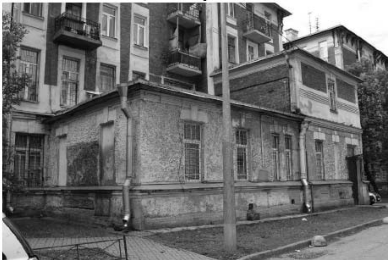
Фото 34. Вид на фасад одно-двухэтажной части объекта культурного наследия регионального значения «Жилой корпус» по адресу: Санкт-Петербург, Гаванская улица, дом 47, литера В.
