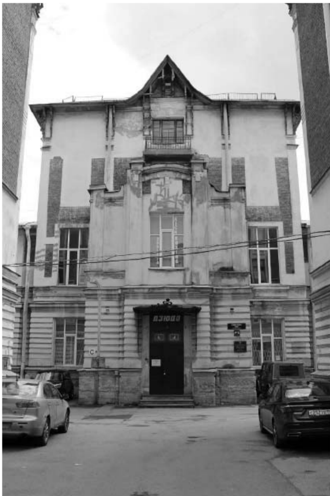
Фото 24. Вид на западный фасад объекта культурного наследия регионального значения «Жилой корпус» по адресу: Санкт-Петербург, Гаванская улица, дом 47, литера Б.
