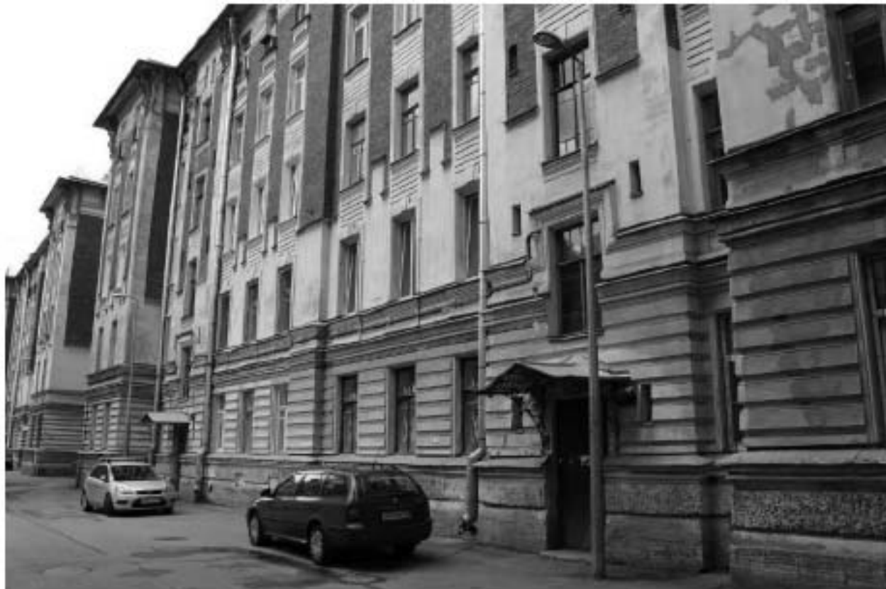
Фото 68. Вид на восточный фасад объекта культурного наследия регионального значения «Жилой корпус» по адресу: Санкт-Петербург, Гаванская улица, дом 47, литера Д.
