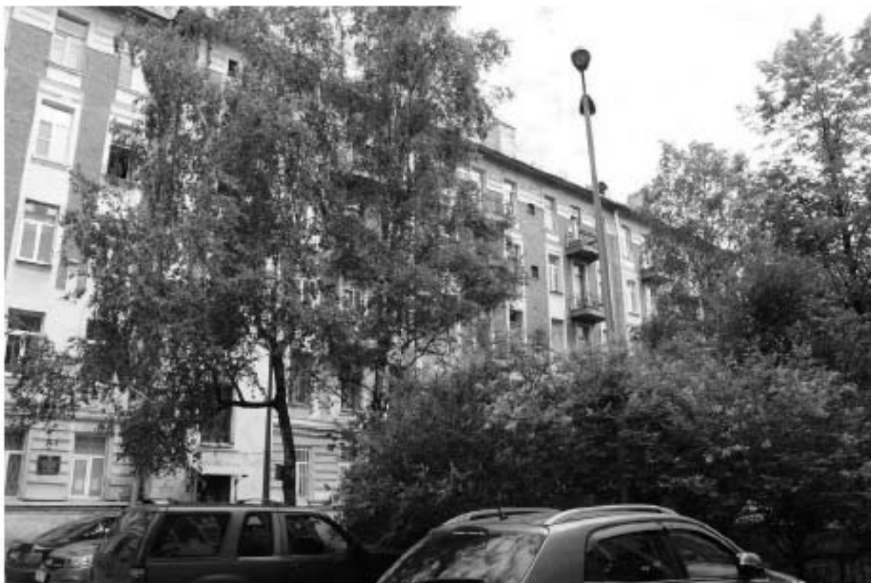
Фото 19. Вид на южный фасад объекта культурного наследия регионального значения «Жилой корпус» по адресу: Санкт-Петербург, Гаванская улица, дом 47, литера Б.
