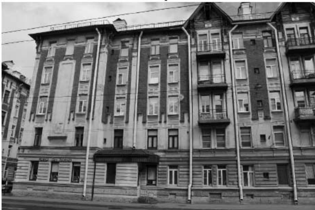
Фото 4. Вид на южный фасад объекта культурного наследия регионального значения «Жилой корпус» по адресу: Санкт-Петербург, Гаванская улица, дом 47, литера А.
