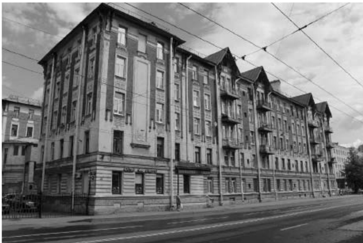
Фото 3. Вид на южный фасад объекта культурного наследия регионального значения «Жилой корпус» по адресу: Санкт-Петербург, Гаванская улица, дом 47, литера А.
