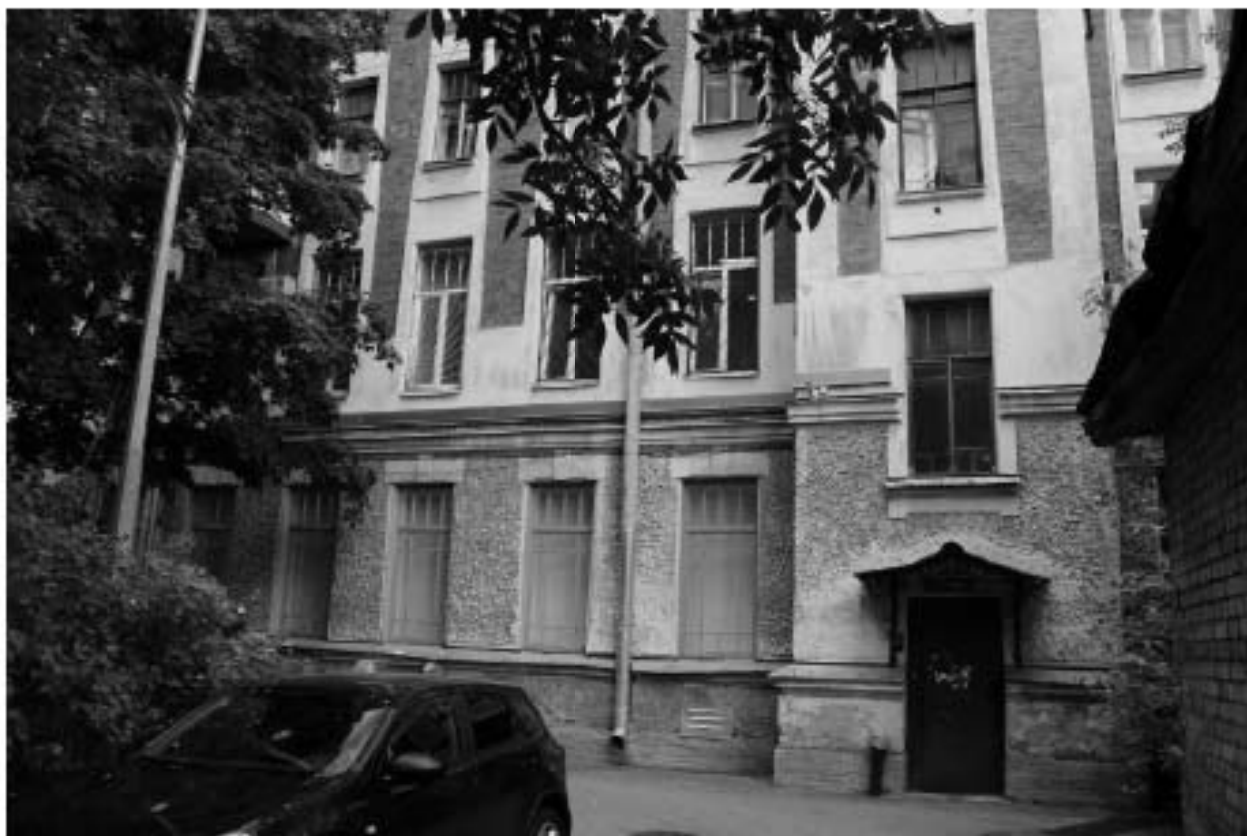
Фото 39. Вид на южный фасад объекта культурного наследия регионального значения «Жилой корпус» по адресу: Санкт-Петербург, Гаванская улица, дом 47, литера В.
