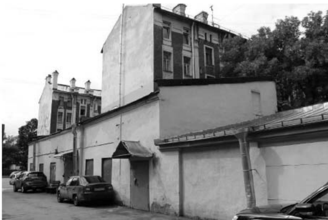
Фото 49. Вид на поздние пристройки, примыкающие к объектам культурного наследия с востока.
