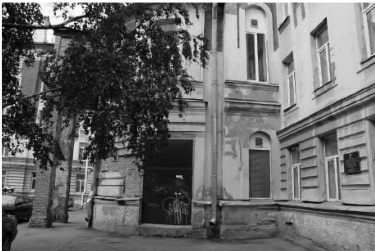
Фото 17. Вид на двухэтажный ризалит объекта культурного наследия регионального значения «Жилой корпус» по адресу: Санкт-Петербург, Гаванская улица, дом 47, литера Б с востока.
