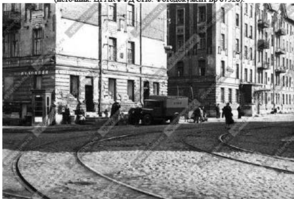
Илл. 111. Фрагменты фасадов 2-ух жилых домов Жилого комплекса «Гаванский рабочий городок» (Гаванская ул., 47; Малый пр., 69, 71). 1955-1960 гг. (источник: ЦГАКФФД СПб. Фотодокумент Бр 67529).
