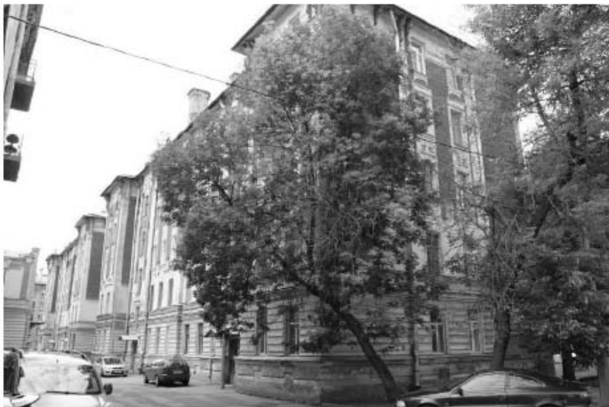
Фото 67. Вид на восточный и северный фасады объекта культурного наследия регионального значения «Жилой корпус» по адресу: Санкт-Петербург, Гаванская улица, дом 47, литера Д.
