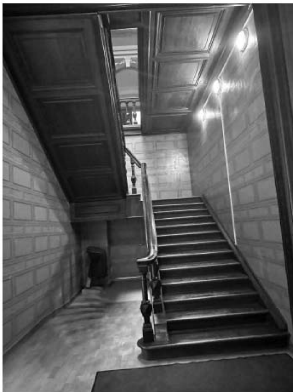
Фото 20. 1 этаж. Парадная деревянная лестница
