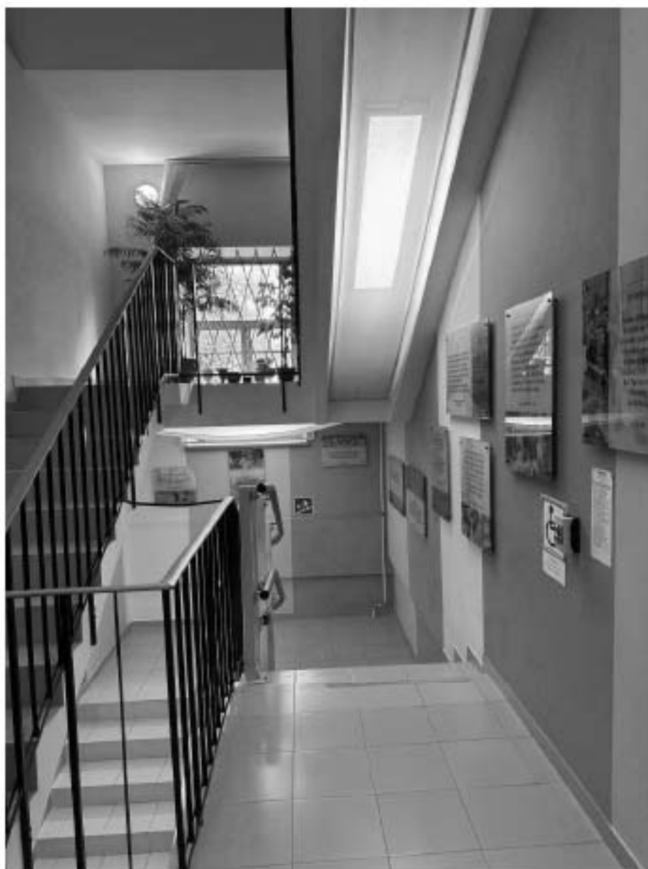
Фото 30. 2 этаж. Помещение 42. Лестница
