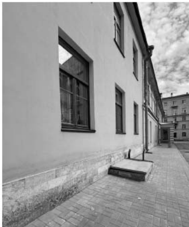
Фото 2. Прямо́к аварийного выхода из подвала
