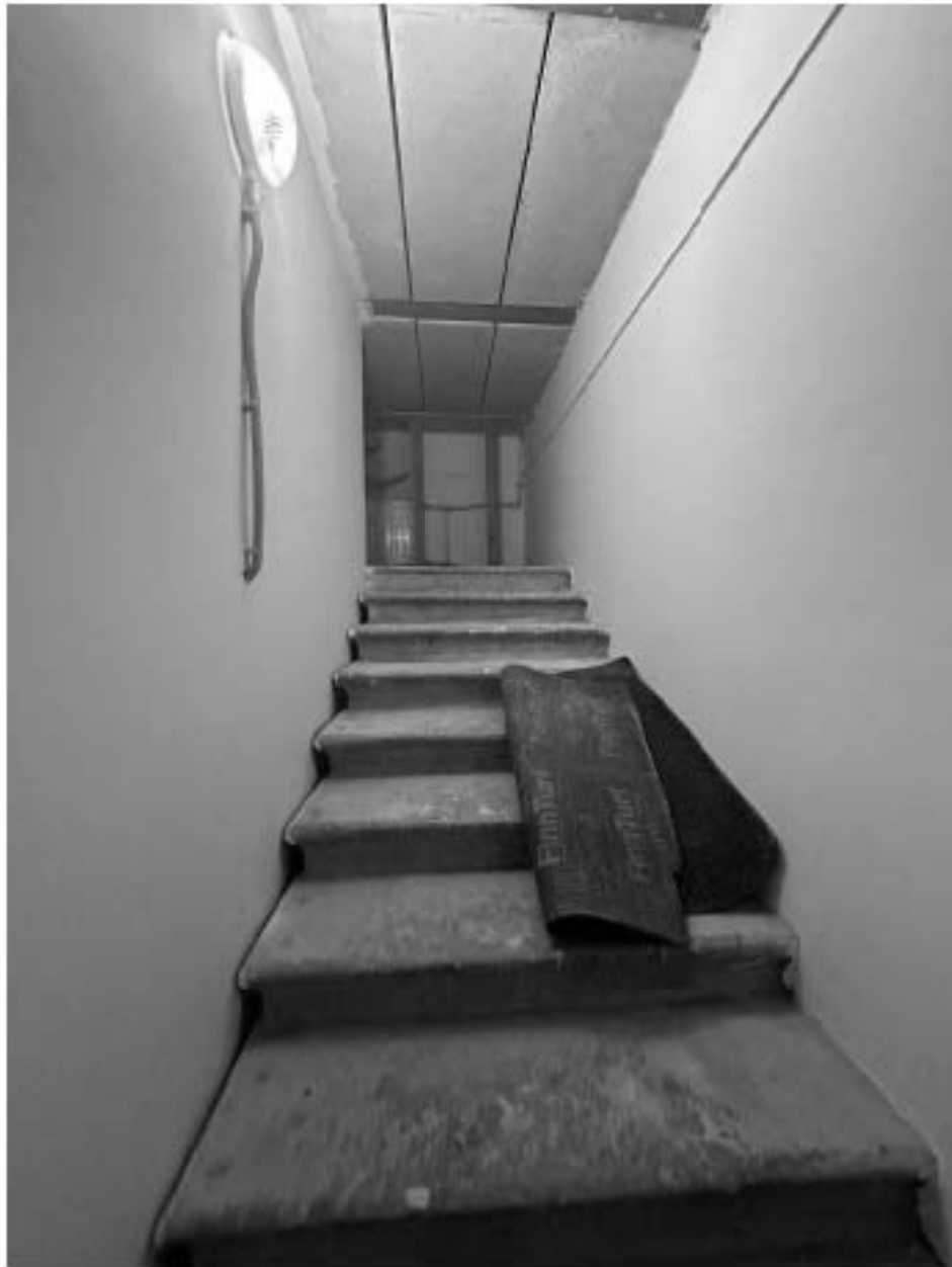
Фото 12. Лестница в пределах подвала и первого этажа
