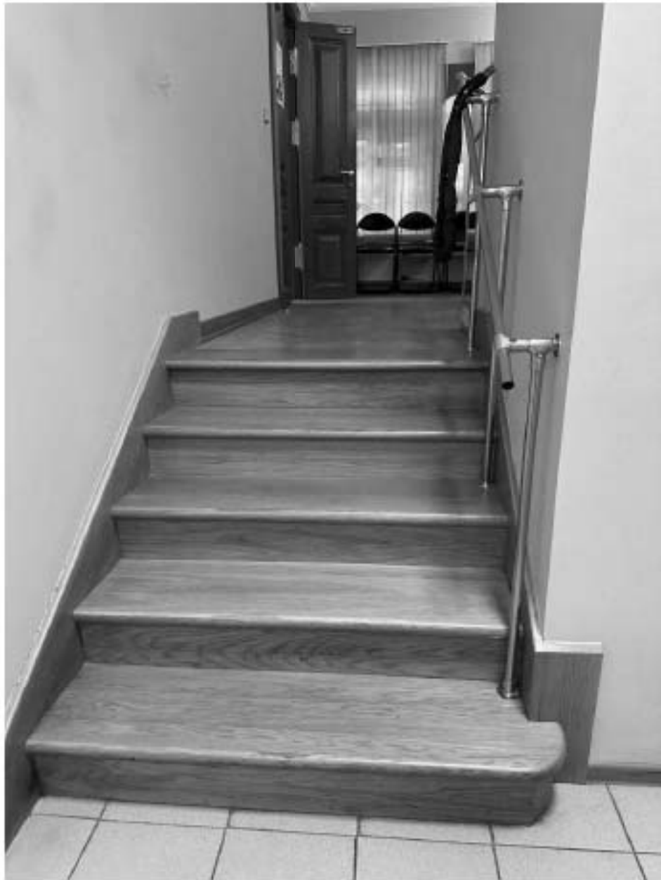
Фото 19. 1 этаж. Помещение 36. Лестница
