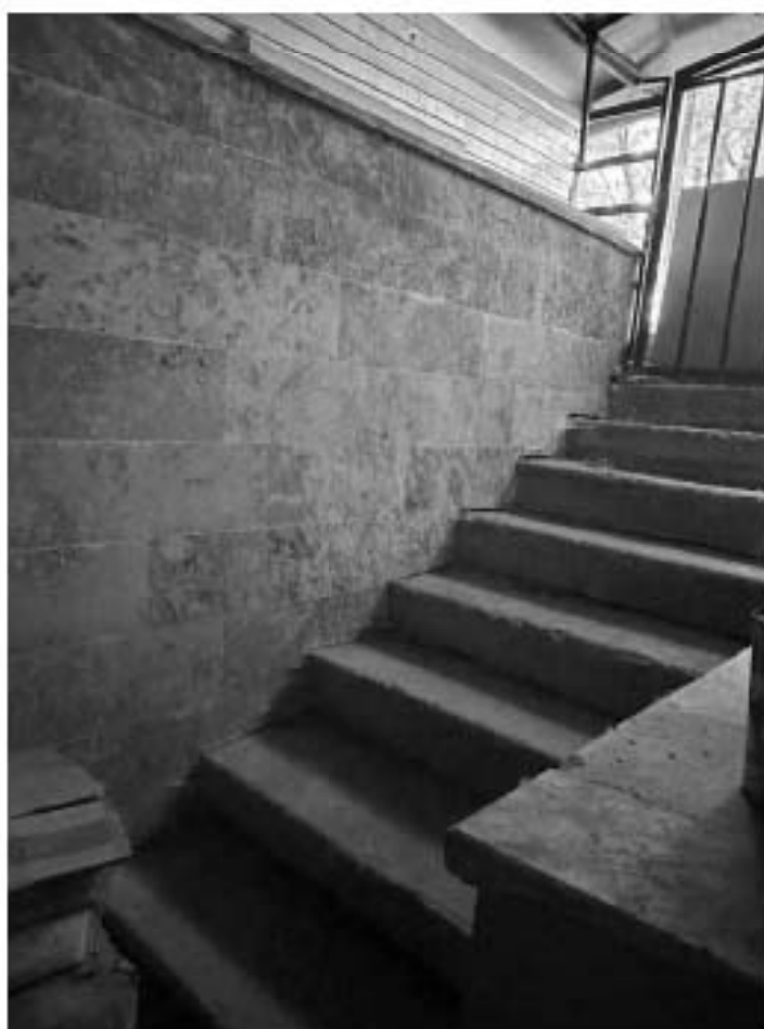
Фото 8. Подвал. Эвакуационный выход
