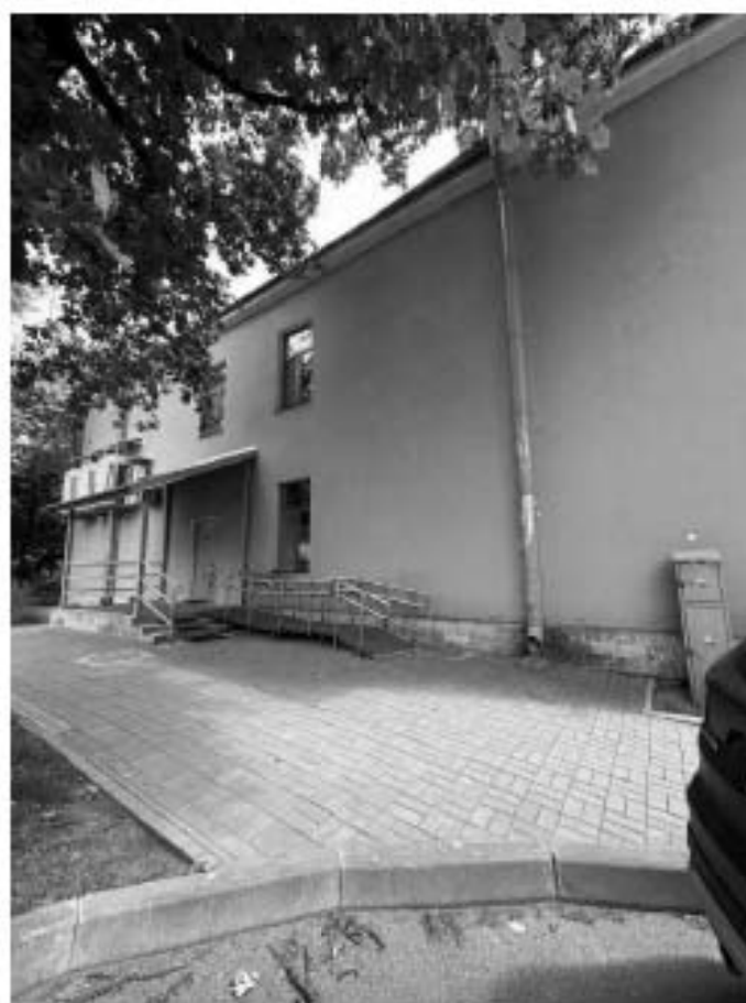
Фото 5. Выход из здания в сторону дворовой территории
