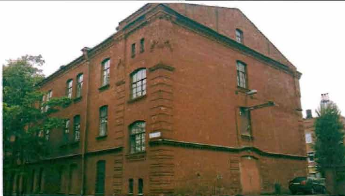
Фото 30. Северный фасад. Общий вид.
