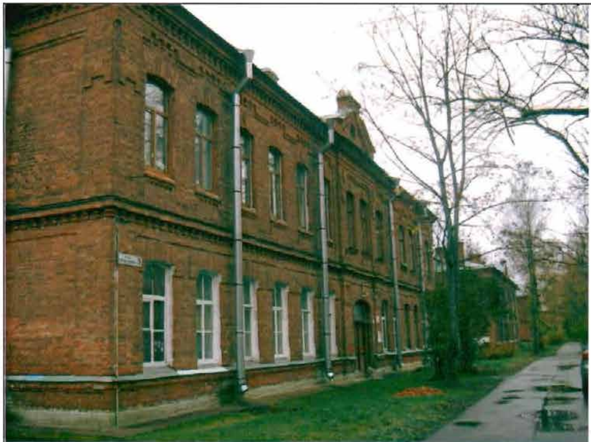
Фото 146. Западный фасад. Общий вид.
