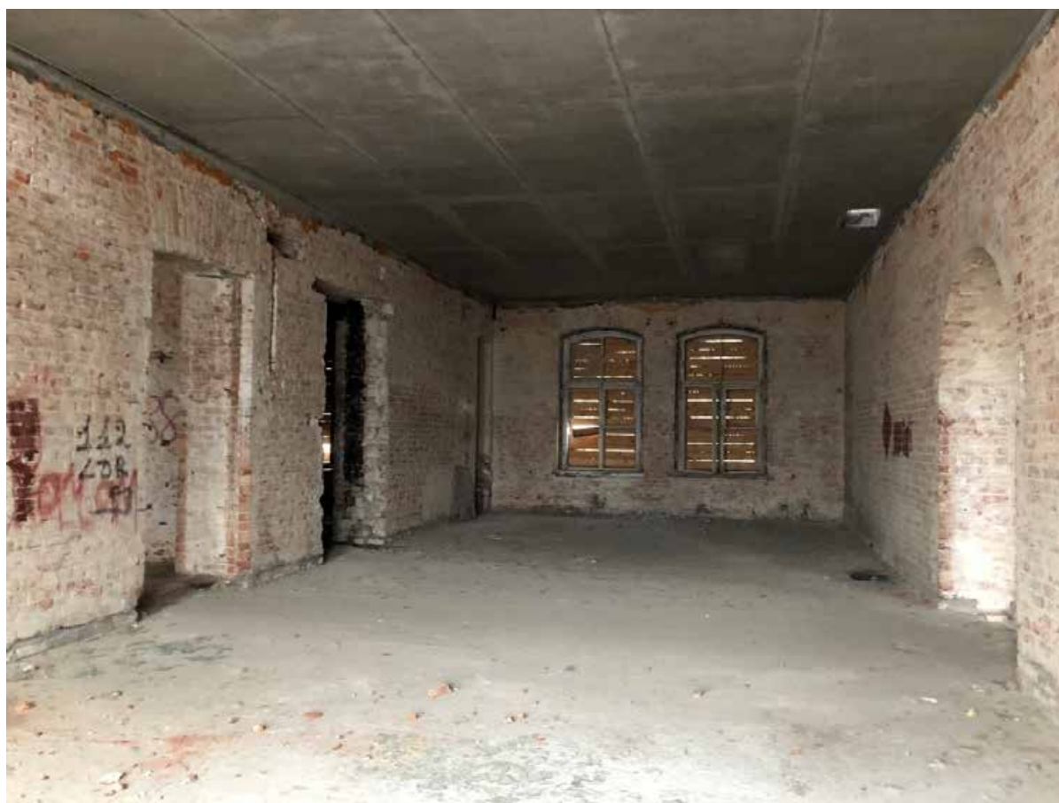
Фото 17. Помещения 2-го этажа.
