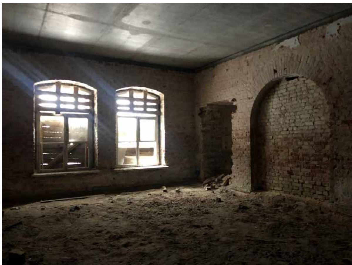
Фото 3. Помещения 1-го этажа.
