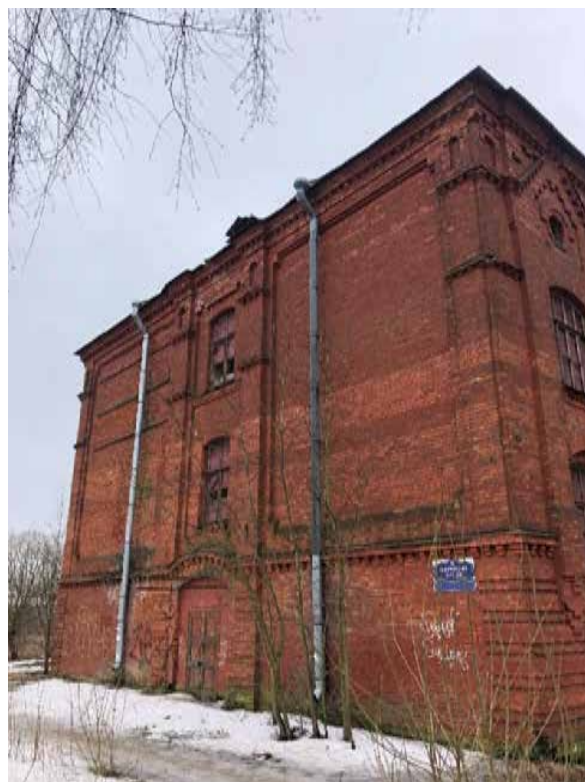
Фото 8. Вид на северный фасад.
