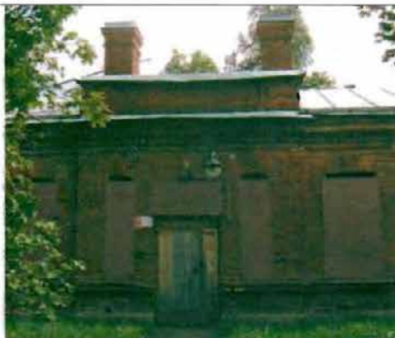
Фото 99. Западный фасад. Центральный часть. Общий вид.
