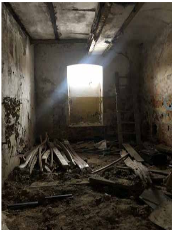
Фото 1. Помещения 1-го этажа.
