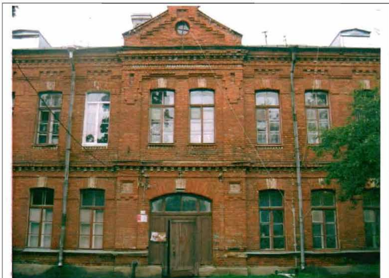
Фото 104. Восточный фасад. Центральная часть. Общий вид.
