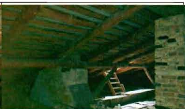
Фото 63. Конструкции крыши. Общий вид.
