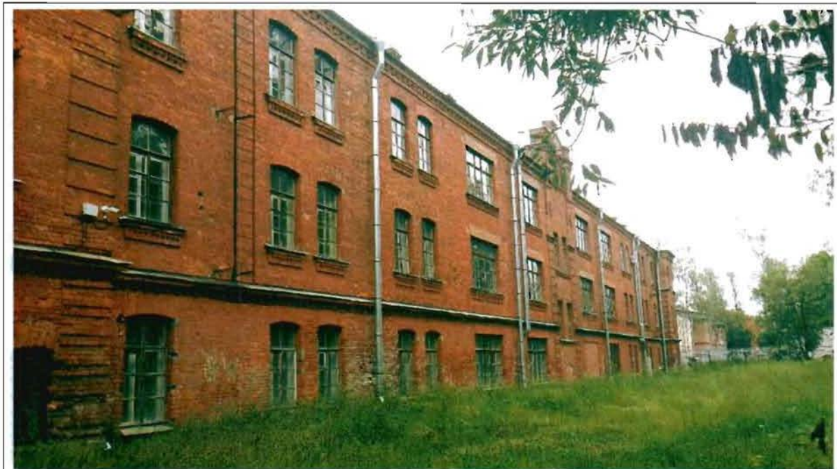
Фото 48. Западный фасад. Общий вид.
