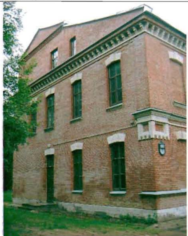
Фото 68. Восточный фасад. Общий вид.
