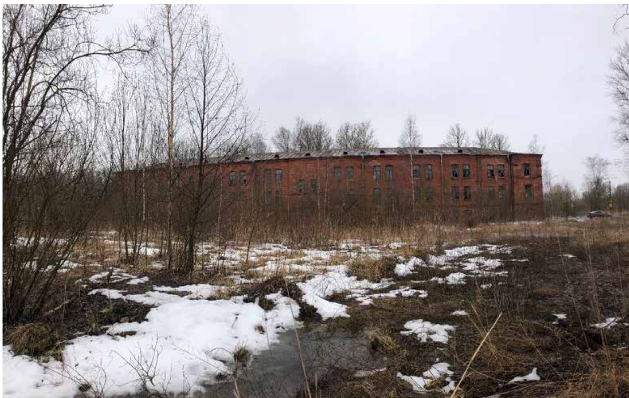
Фото 5. Вид на восточный фасад.
