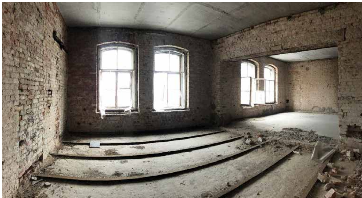
Фото 25. Помещения 3-го этажа.
