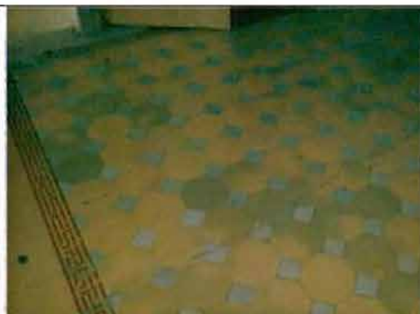
Фото 58. Интерьер. Покрытие межэтажной площадки лестницы в центральной части здания. Фрагмент.
