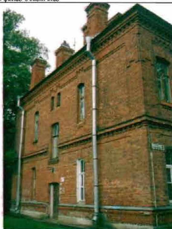
Фото 148. Северный фасад. Общий вид.
