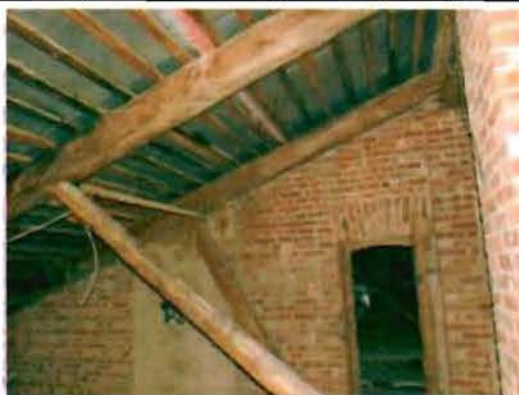
Фото 127. Конструкции крыши. Общий вид.
