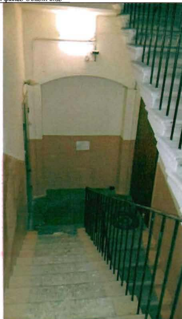
Фото 173. Лестница № 1 в северной части здания. Фрагмент.
