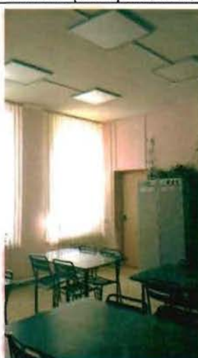
Фото 169. Помещение в уровне 1-го этажа. Общий вид.
