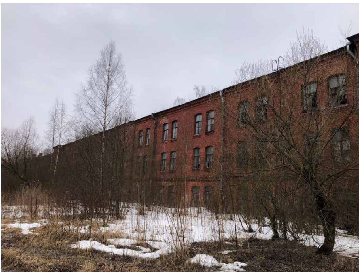
Фото 6. Вид на восточный фасад.
