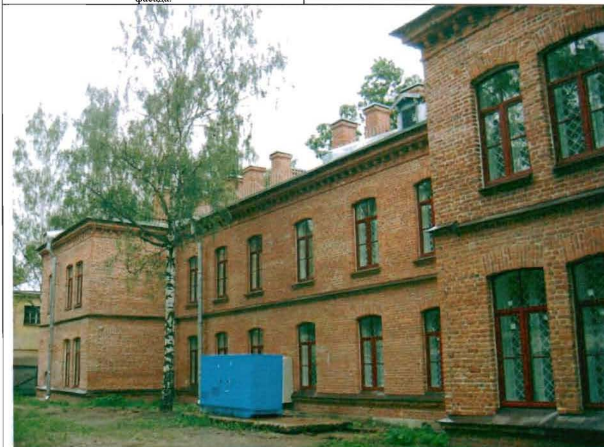
Фото 42. Западный фасад. Общий вид.
