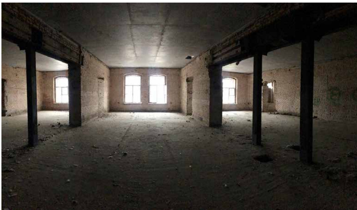
Фото 19. Помещения 2-го этажа.
