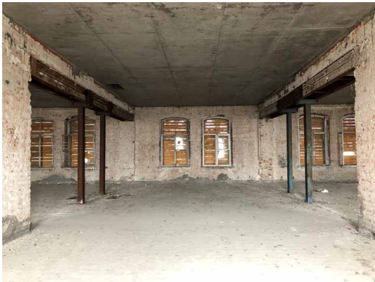
Фото 32. Помещения 3-го этажа.
