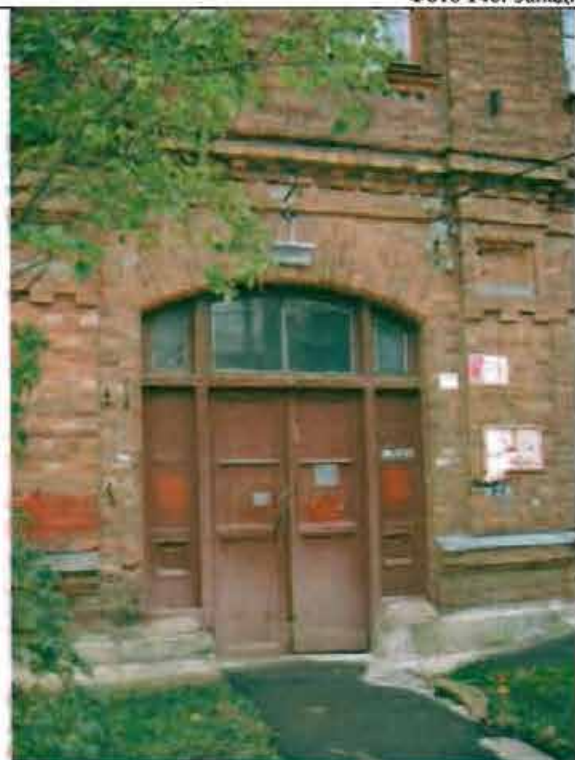
Фото 147. Дверной проем западного фасада. Общий вид.
