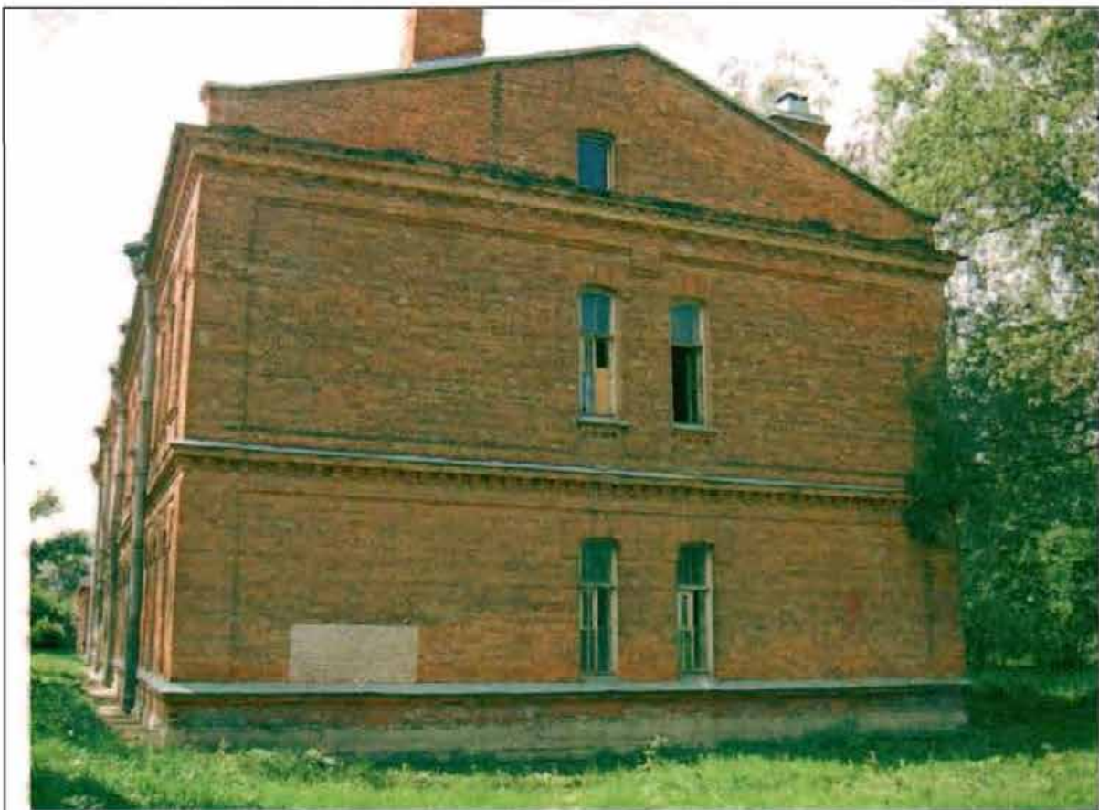
Фото 180. Северный фасад. Общий вид.
