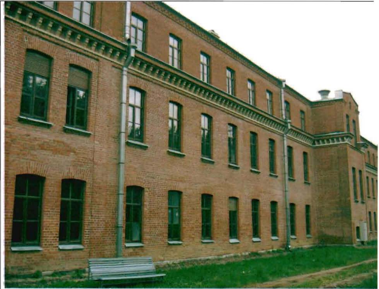
Фото 66. Южный фасад. Общий вид. 05.07.2016.
