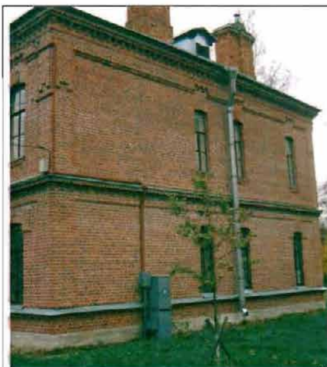
Фото 134. Южный фасад. Общий вид.
