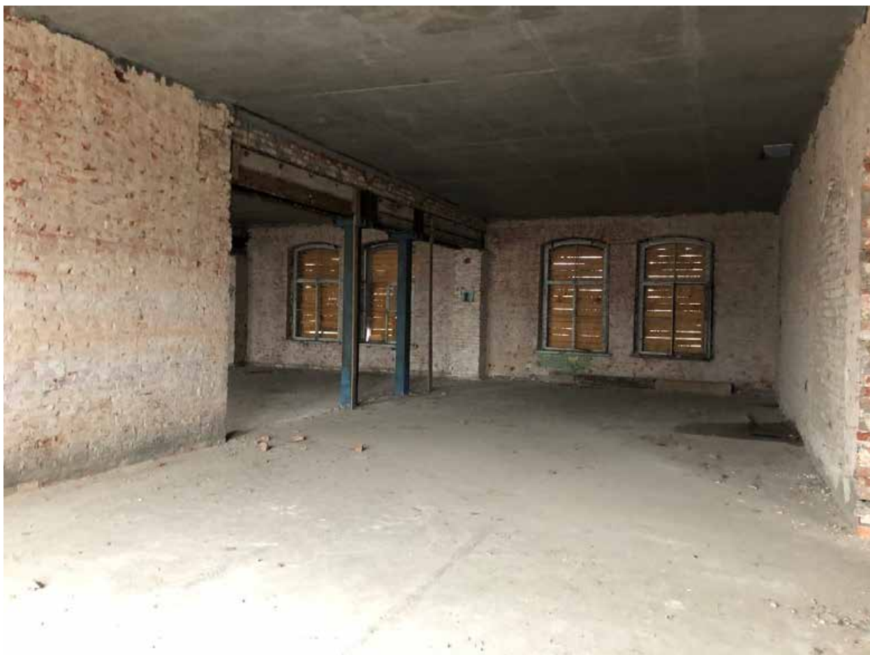
Фото 18. Помещения 2-го этажа.
