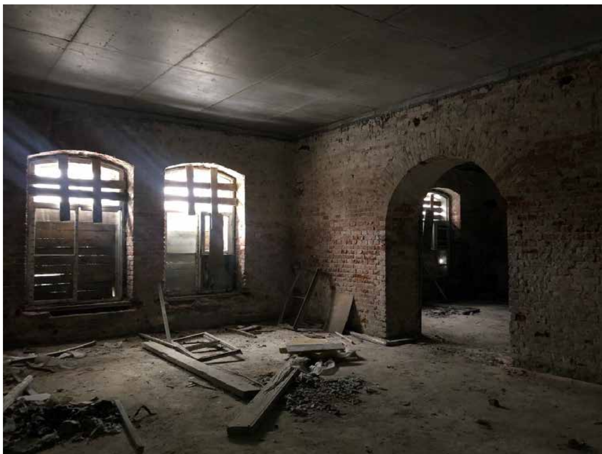
Фото 9. Помещения 1-го этажа.
