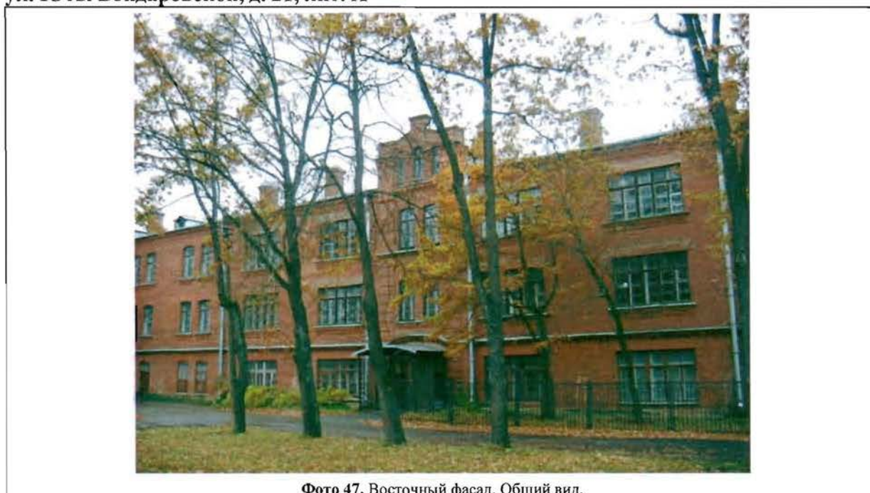
Фото 47. Восточный фасад. Общий вид.
