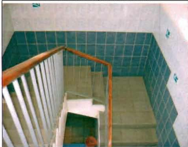
Фото 114. Лестница. Общий вид.
