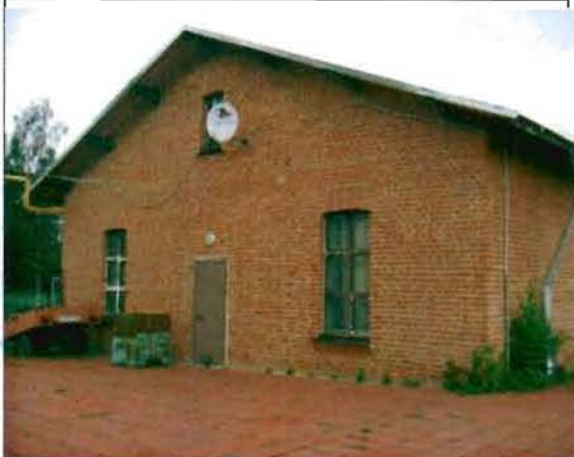
Фото 21. Южный фасад. Общий вид.
