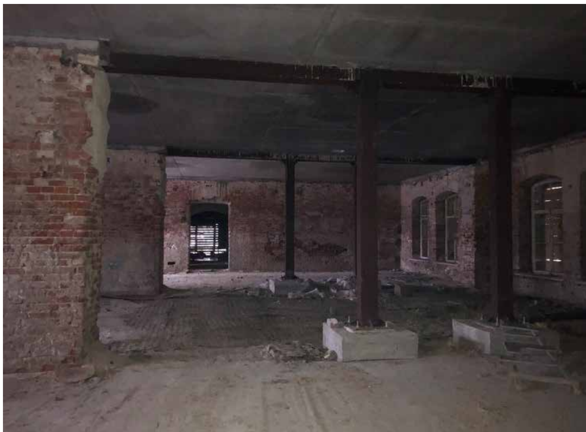
Фото 10. Помещения 1-го этажа.
