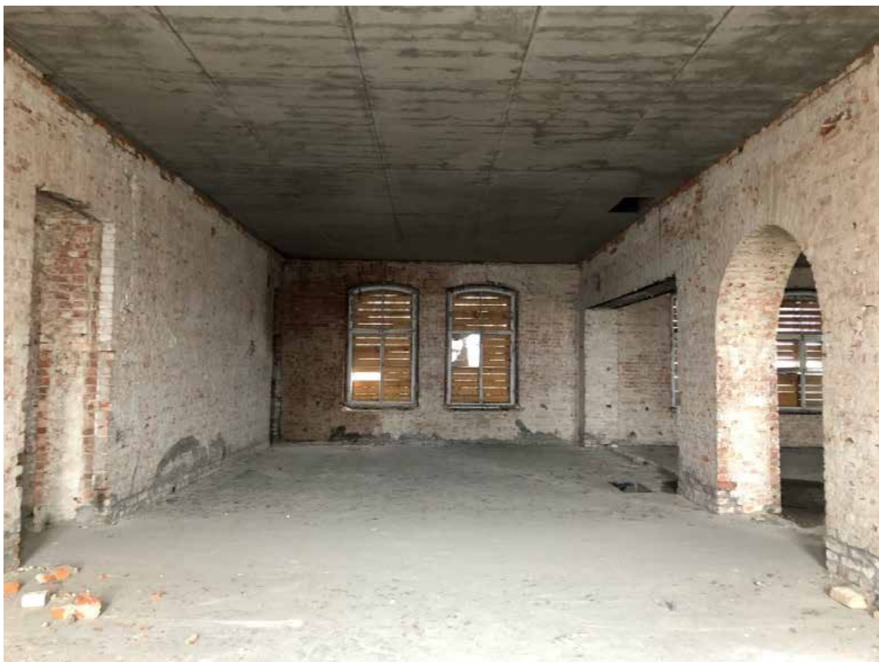
Фото 29. Помещения 3-го этажа.
