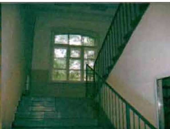
Фото 59. Интерьер. Лестница в северной части здания. Фрагмент.
