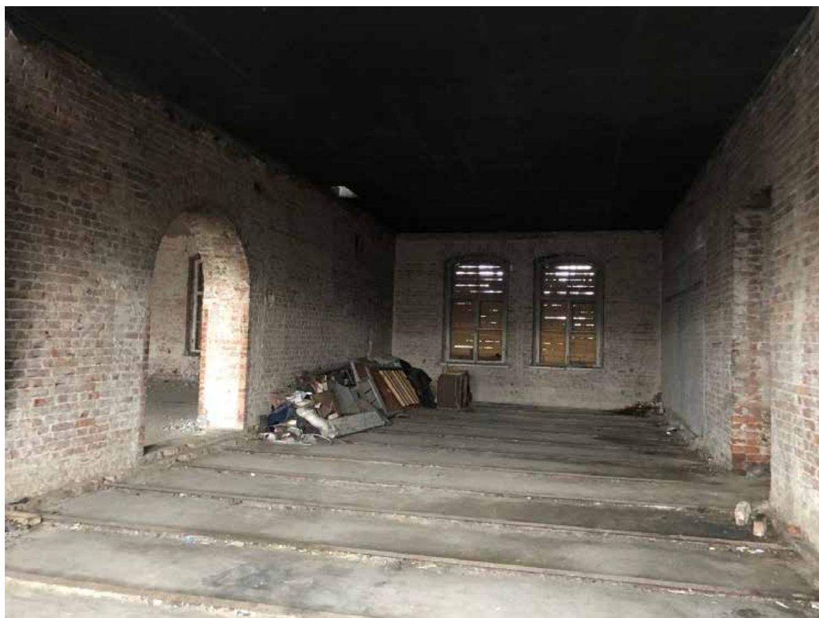
Фото 15. Помещения 2-го этажа.
