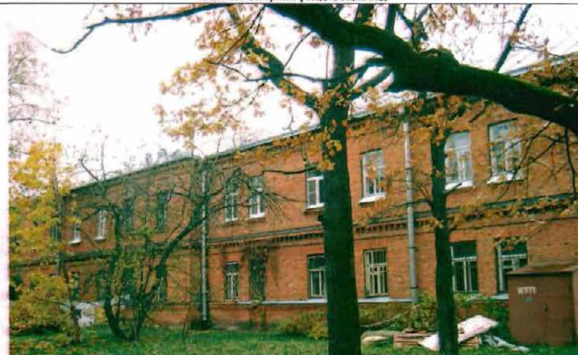
Фото 84. Южный фасад. Общий вид.
