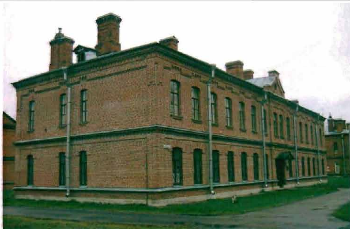
Фото 132. Западный, северный фасады. Общий вид.
