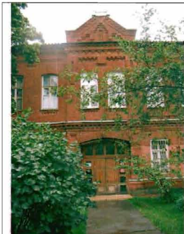
Фото 90. Восточный фасад. Центральная часть. Общий вид.
