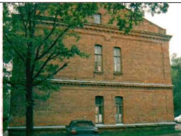
Фото 167. Северный фасад. Общий вид.
