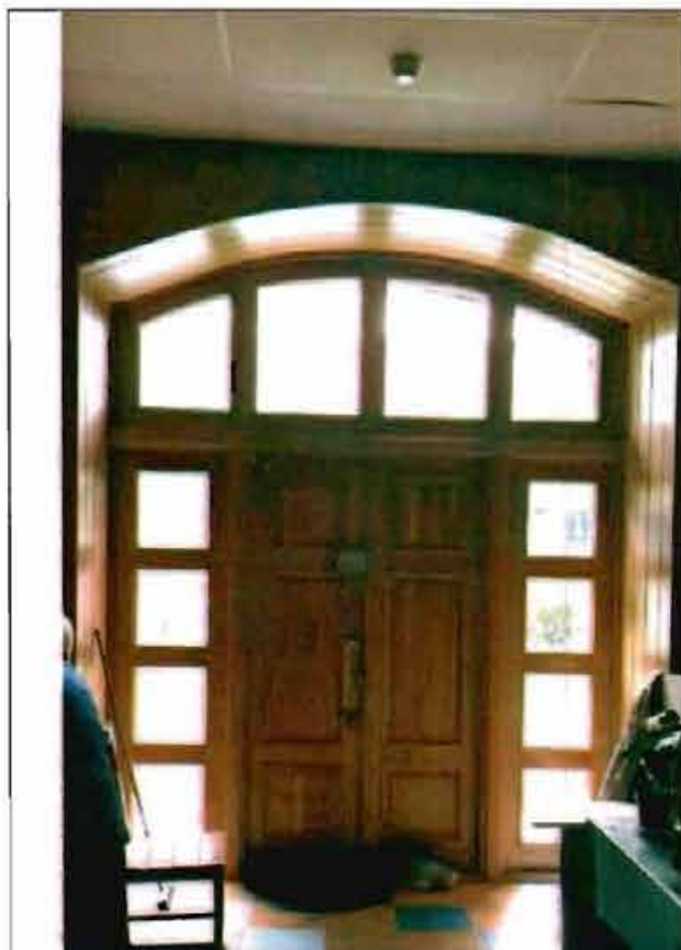
Фото 92. Помещение в уровне 1-го этажа.
