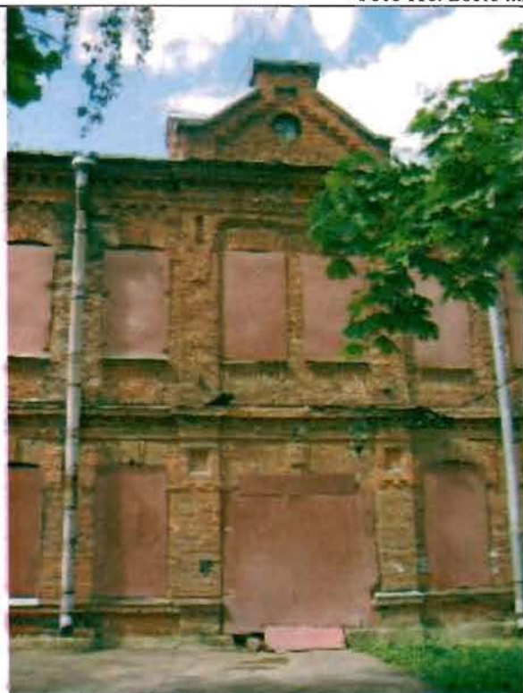
Фото 117. Восточный фасад. Фрагмент центральной части фасада.
