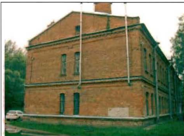
Фото 166. Южный фасад. Общий вид.
