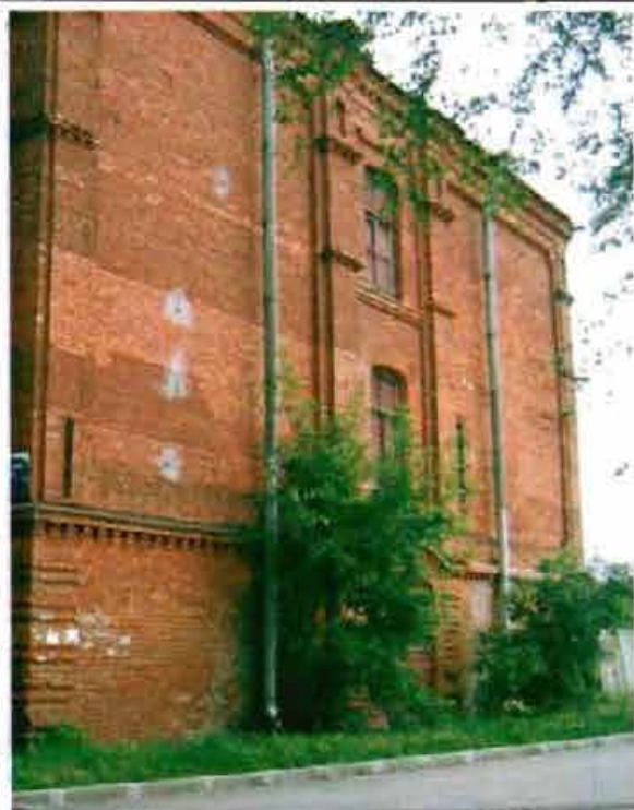
Фото 5. Южный фасад. Общий вид.
