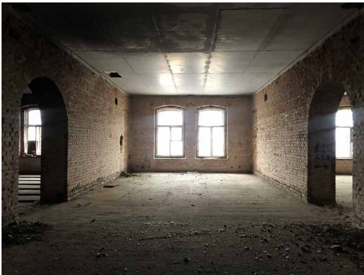
Фото 16. Помещения 2-го этажа.
