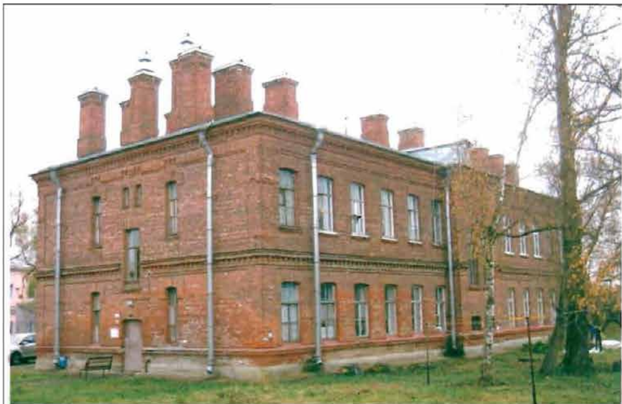
Фото 129. Западный, северный фасады. Общий вид.
