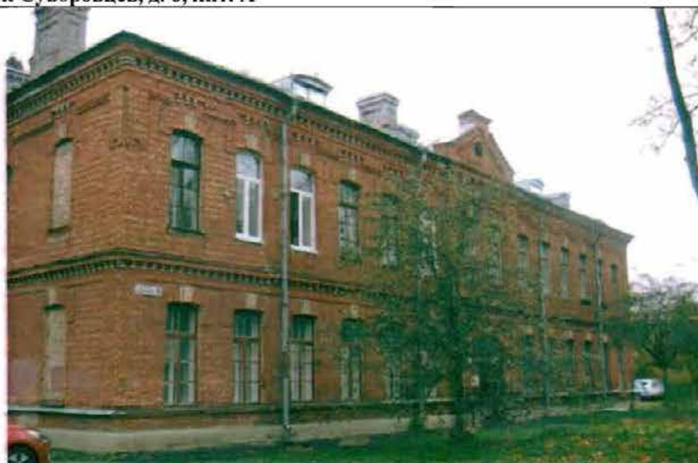
Фото 103. Восточный фасад. Общий вид.
