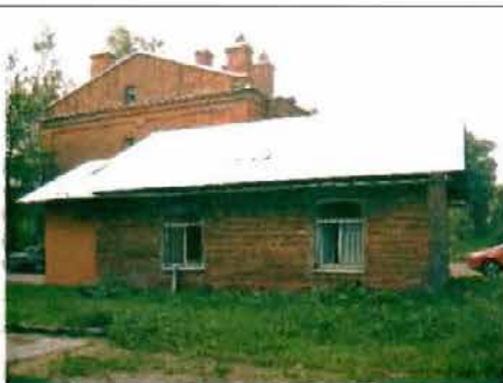
Фото 156. Западный фасад. Общий вид.
