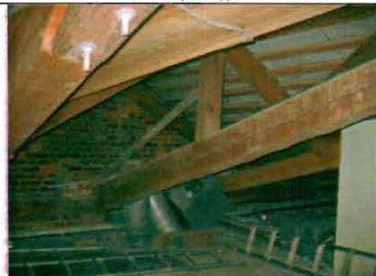
Фото 77. Конструкции крыши. Общий вид.
