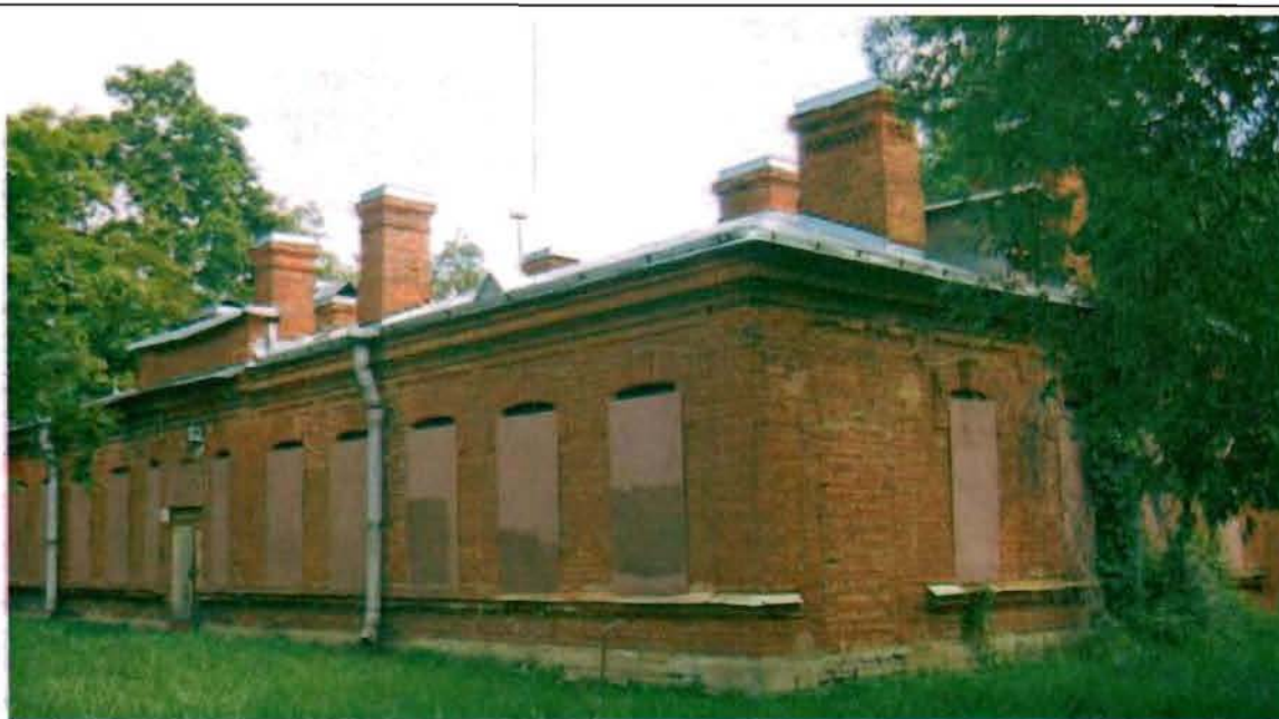
Фото 98. Западный фасад. Общий вид.
