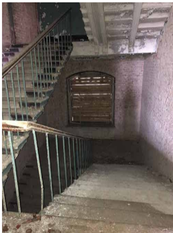
Фото 34. Помещения 3-го этажа. Лестница 1 ЛК.
