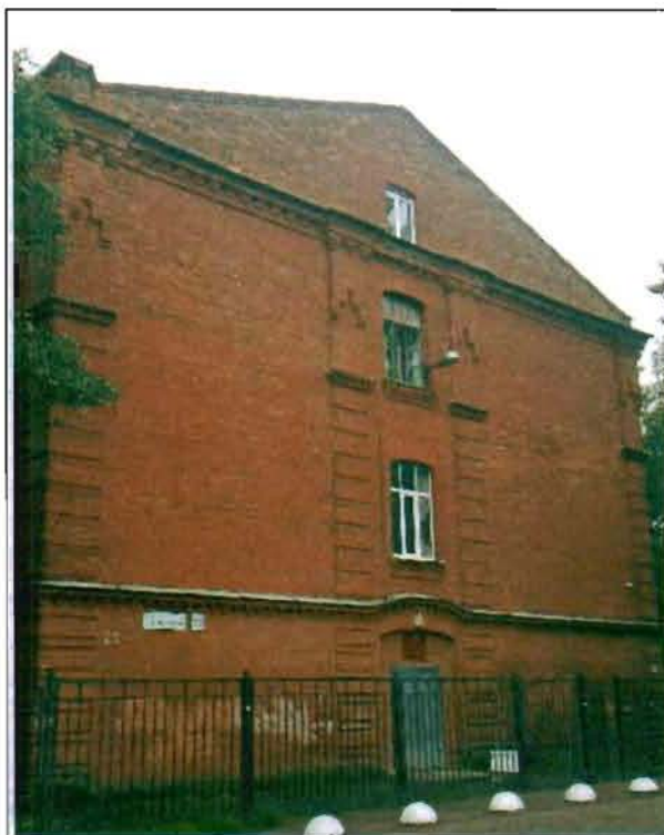
Фото 49. Северный фасад. Общий вид.
