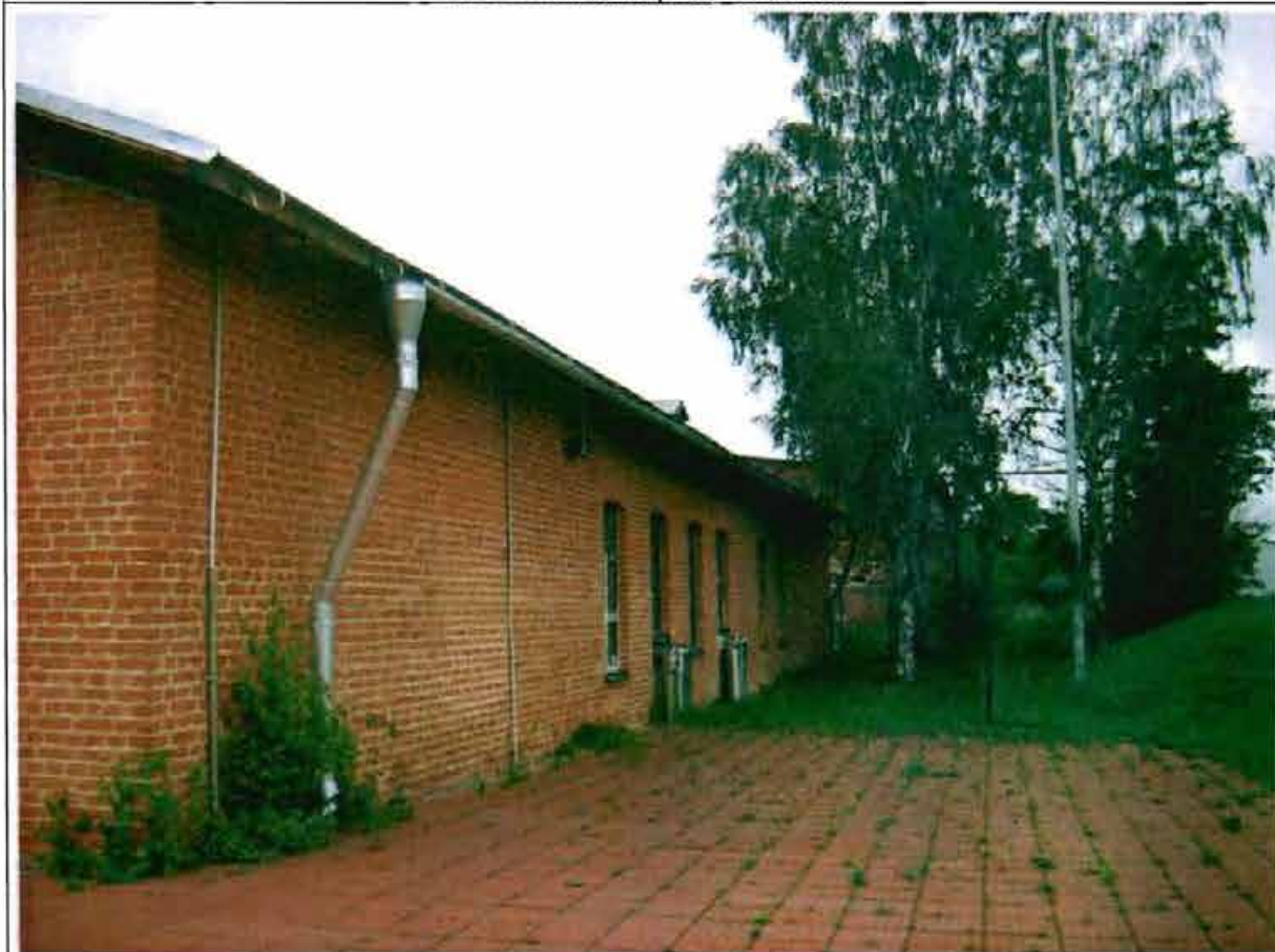
Фото 19. Восточный фасад. Общий вид.
