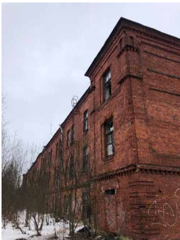
Фото 7. Вид на северный угол восточного фасада.
