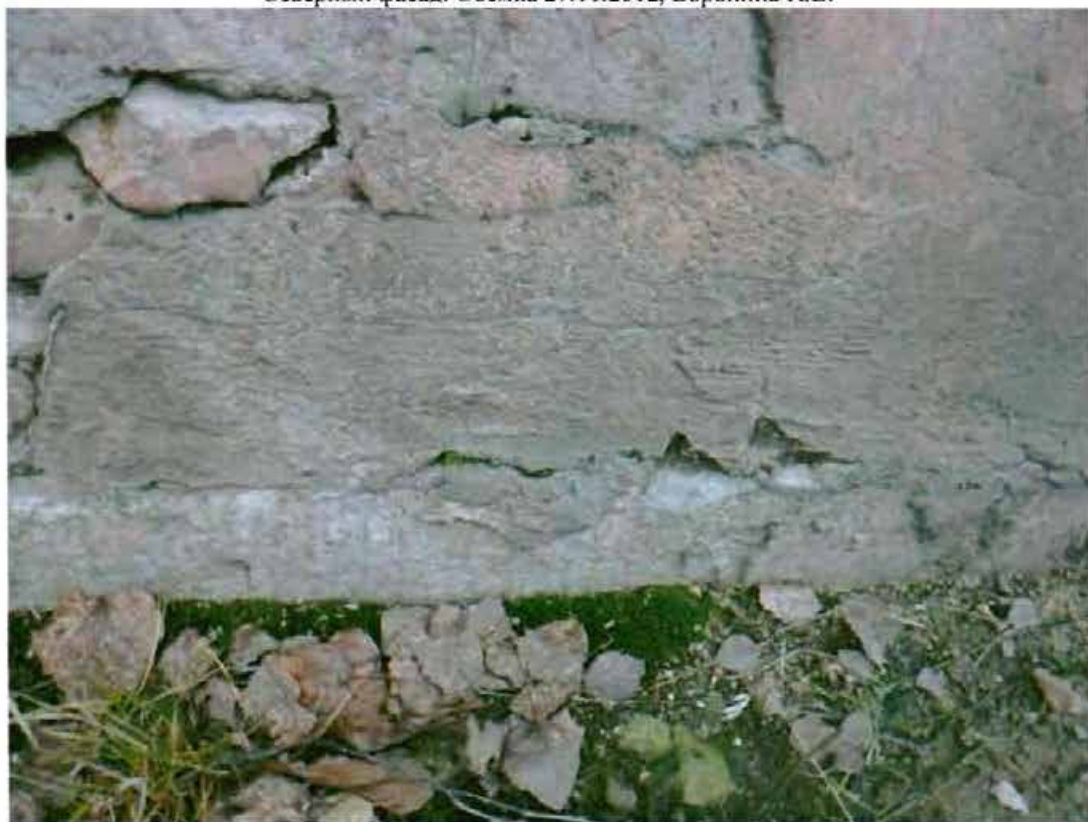
Цоколь, облицованный известняковой скобой. Съемка 27.11.2012, Воронина Н.В.
