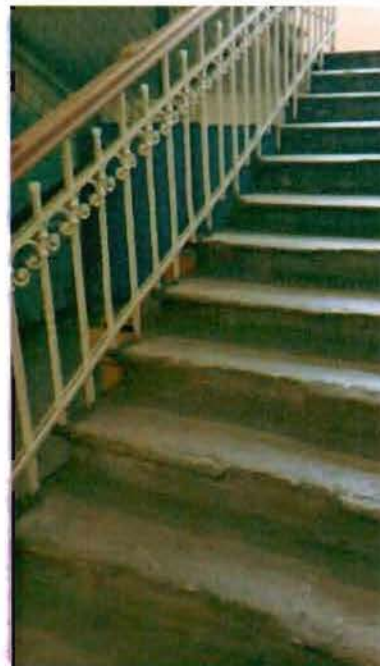
Фото 57. Лестница в центральной части здания. Фрагмент.
