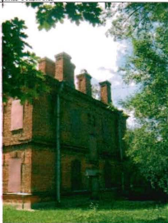
Фото 118. Северный фасад. Общий вид.
