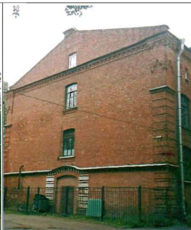
Фото 50. Южный фасад. Общий вид.
