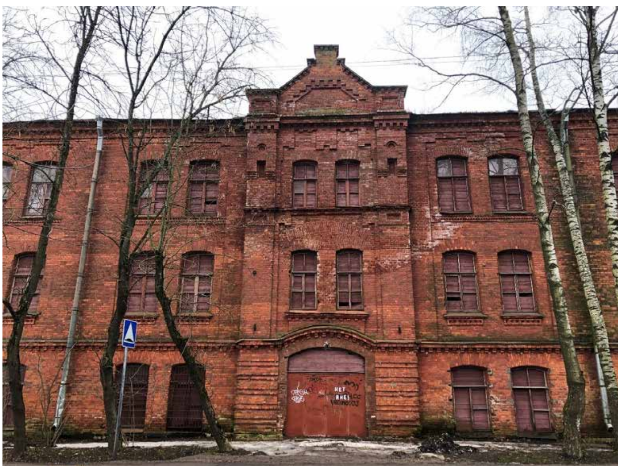
Фото 2. Вид на фрагмент западного фасада.
