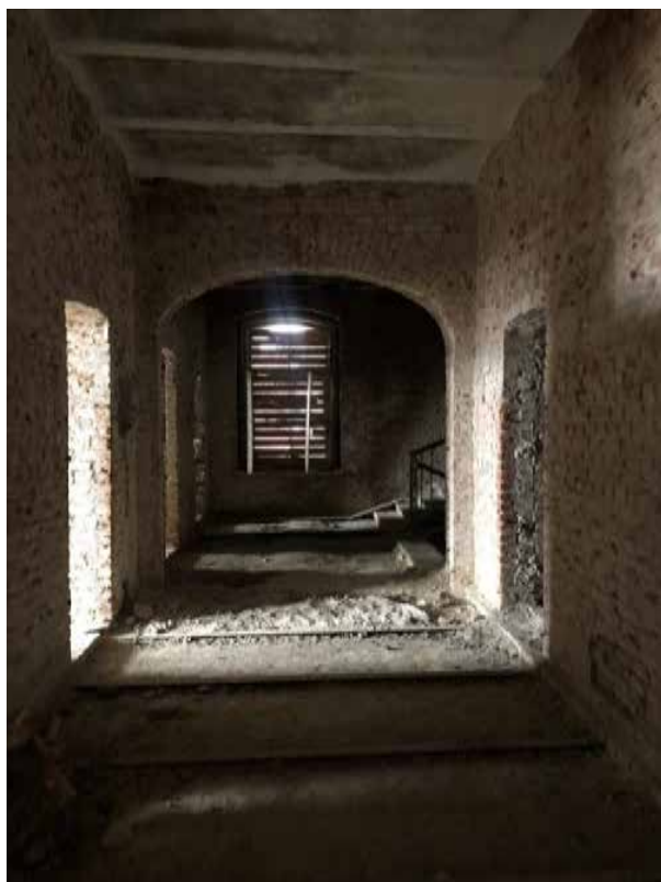
Фото 33. Помещения 3-го этажа.
