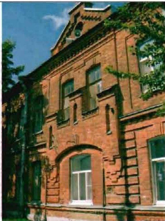
Фото 137. Восточный фасад. Фрагмент.
