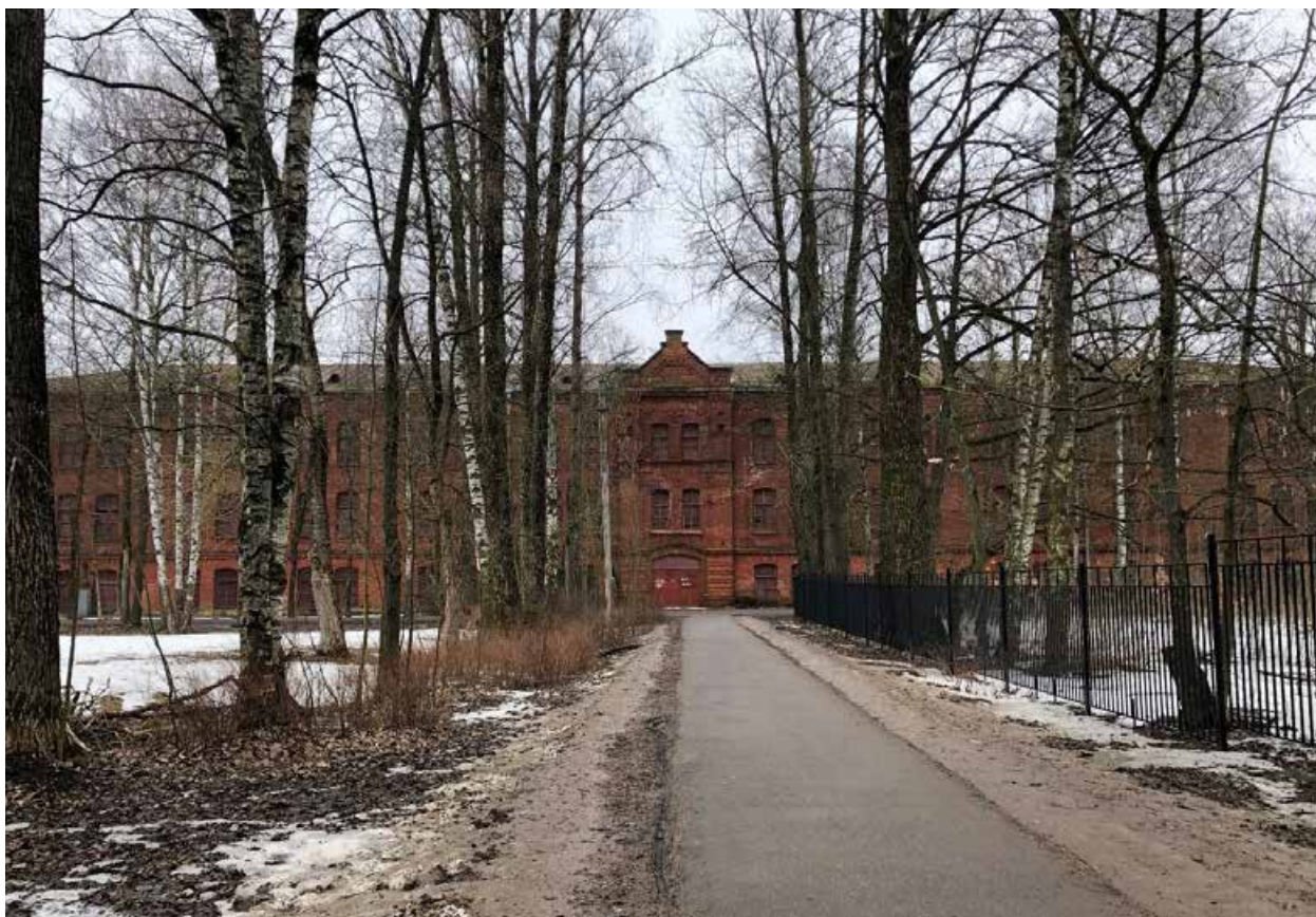
Фото 1. Вид на западный фасад.
