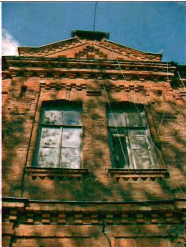
Фото 177. Восточный фасад. Центральная часть. Фрагмент.
