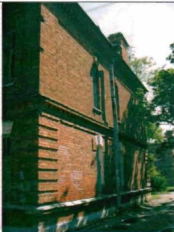
Фото 138. Южный фасад. Общий вид.
