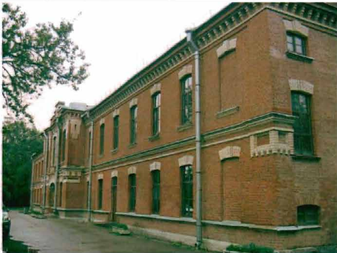
Фото 64. Северный фасад. Общий вид.
