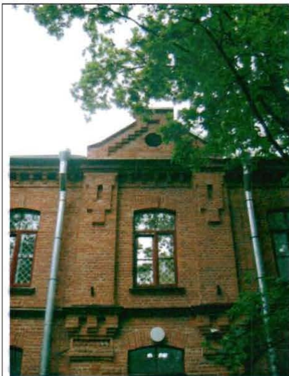
Фото 40. Восточный фасад. Фрагмент центральной части фасада.
