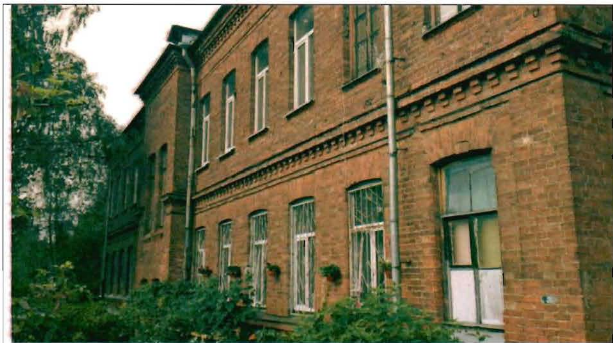
Фото 171. Восточный фасад. Общий вид.
