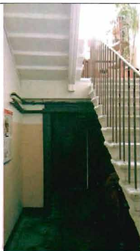
Фото 131. Лестница № 2 в северной части здания. Общий вид.
