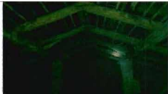
Фото 37. Конструкции крыши. Фрагмент.
