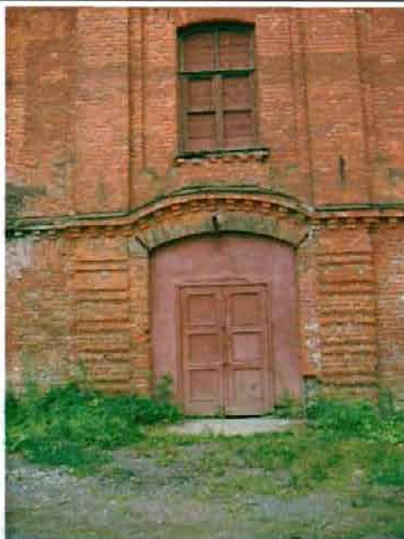
Фото 4. Западный фасад. Фрагмент центральной части фасада.
