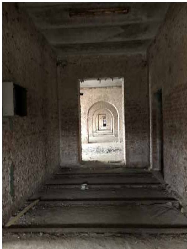
Фото 24. Помещения 3-го этажа.
