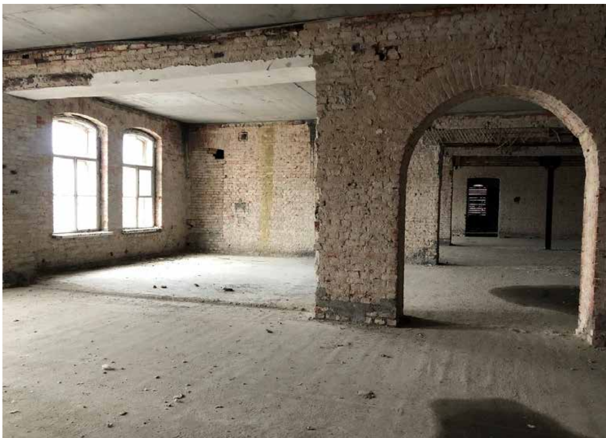
Фото 31. Помещения 3-го этажа.
