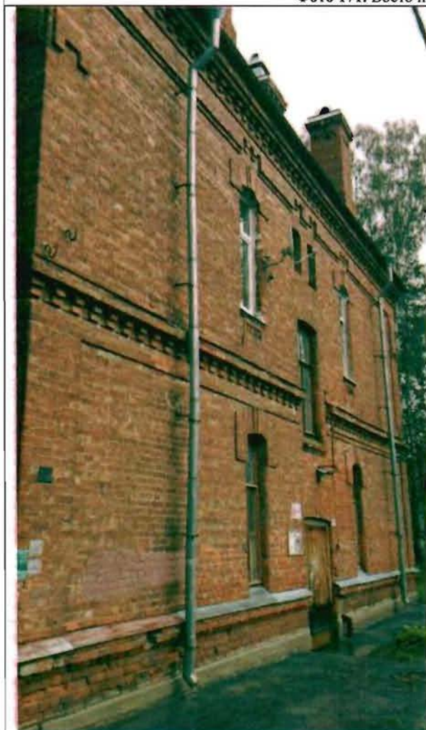
Фото 172. Южный фасад. Общий вид.
