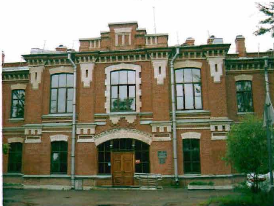
Фото 65. Северный фасад. Фрагмент центральной части фасада.
