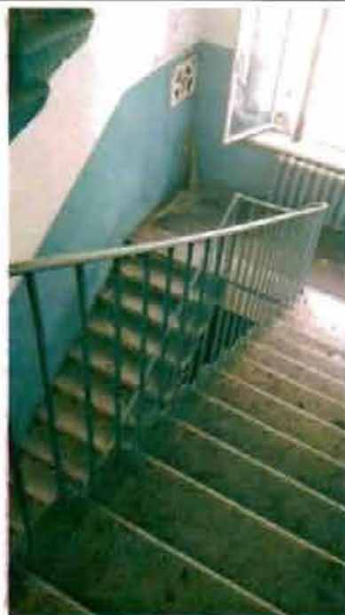
Фото 144. Лестница № 2 в южной части здания. Общий вид.
