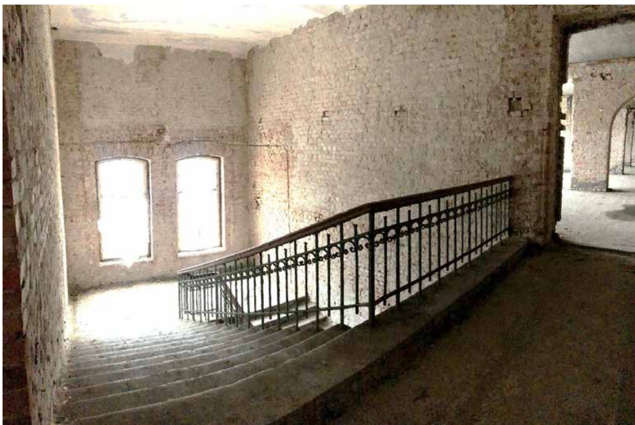
Фото 30. Помещения 3-го этажа. Лестница 2 ЛК.
