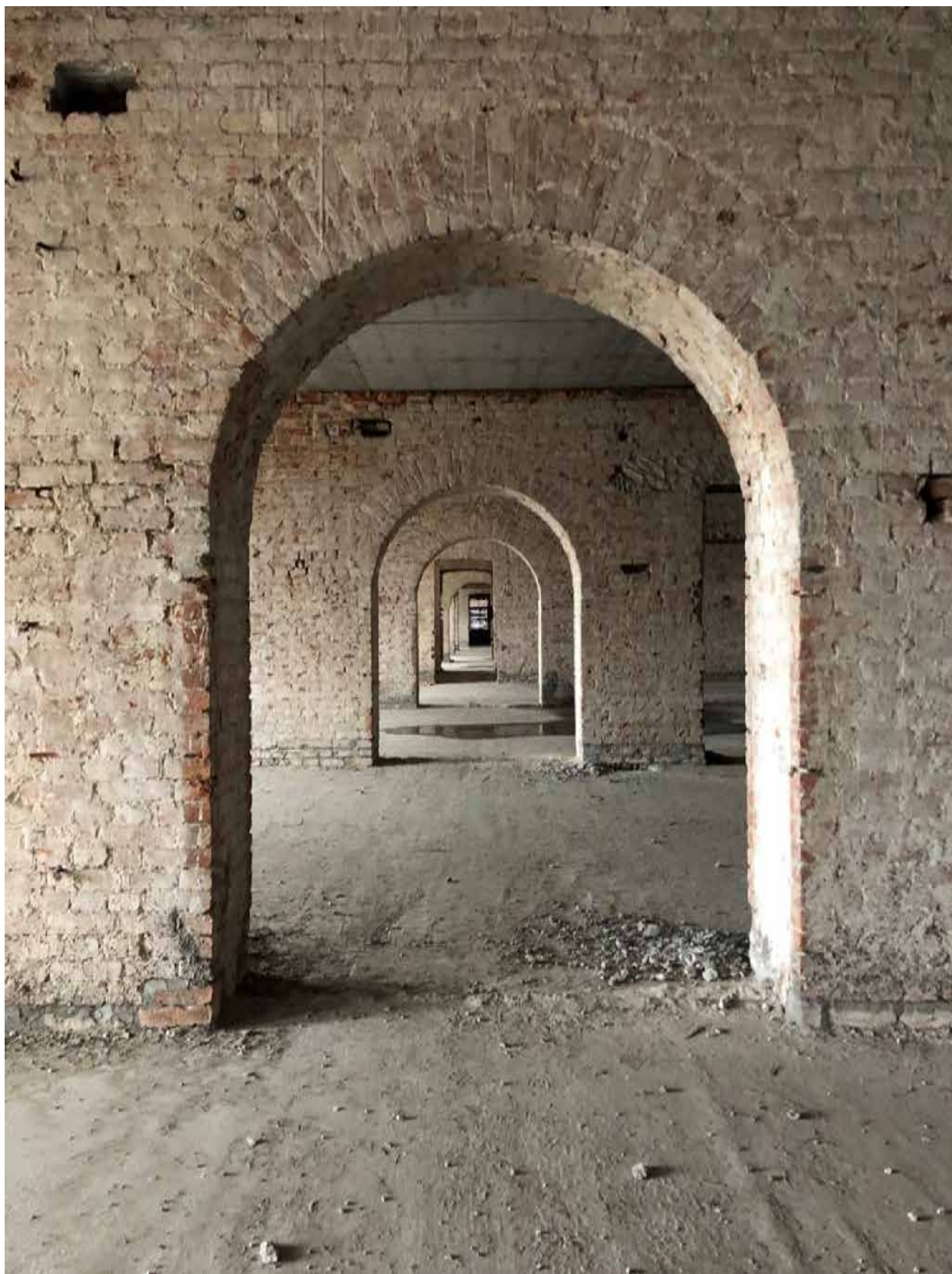
Фото 26. Помещения 3-го этажа.
