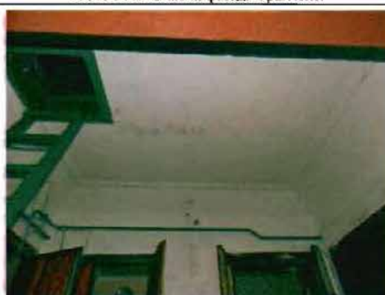
Фото 102. Отделка потолка тамбура. Общий вид.
