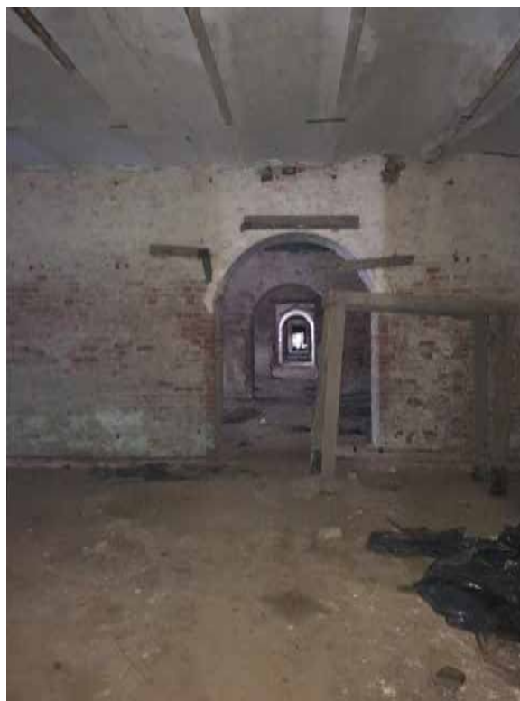
Фото 2. Помещения 1-го этажа.
