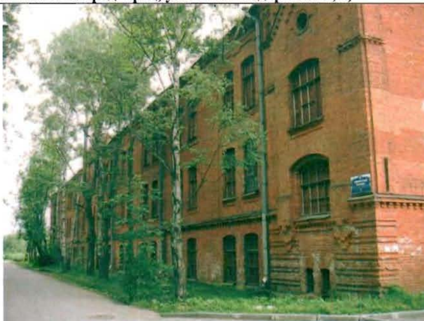
Фото 1. Западный фасад. Общий вид.
