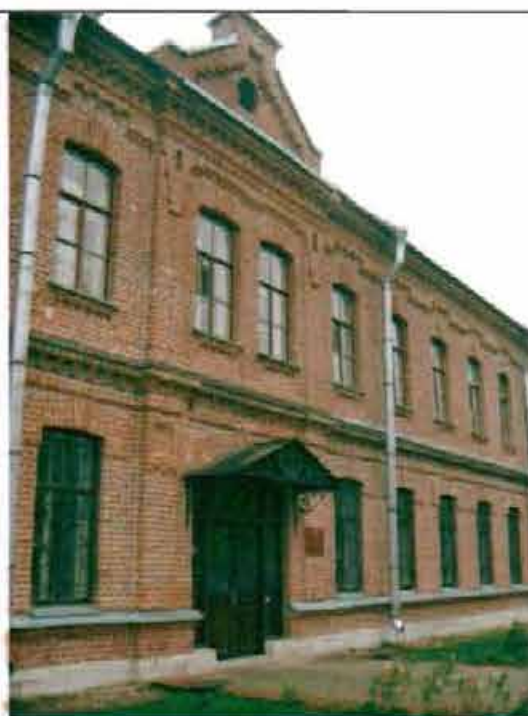
Фото 135. Западный фасад. Фрагмент центральной части фасада.
