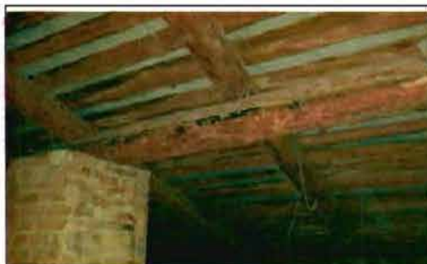
Фото 62. Конструкции крыши. Общий вид.
