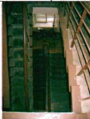
Фото 87. Лестница № 1. Общий вид.
