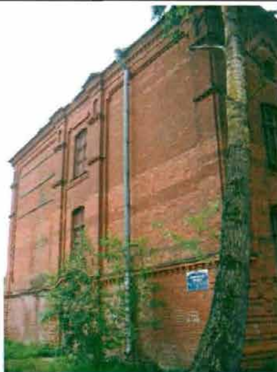
Фото 6. Северный фасад. Общий вид.
