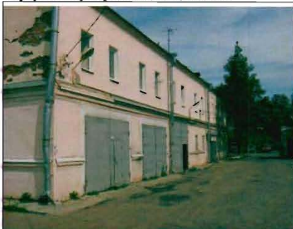
Фото 110. Восточный фасад. Общий вид.
