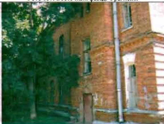
Фото 139. Западный фасад. Фрагмент.
