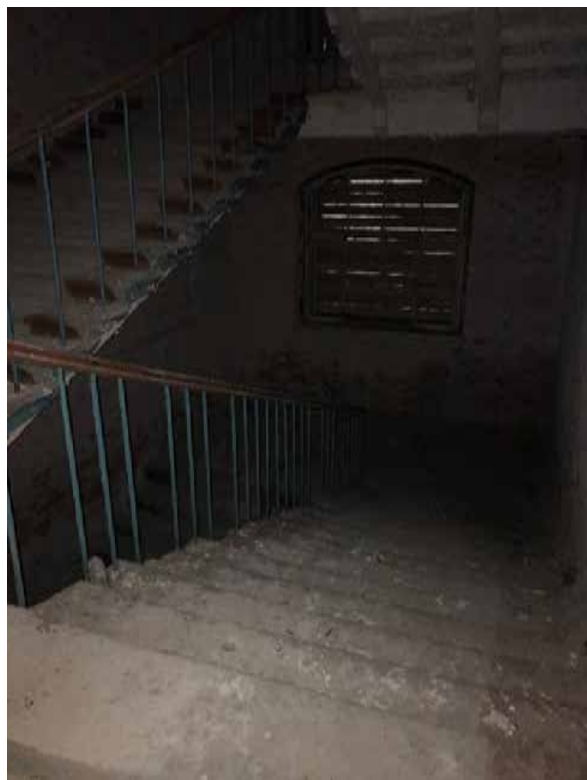
Фото 21. Помещения 2-го этажа. Лестница 1 ЛК.
