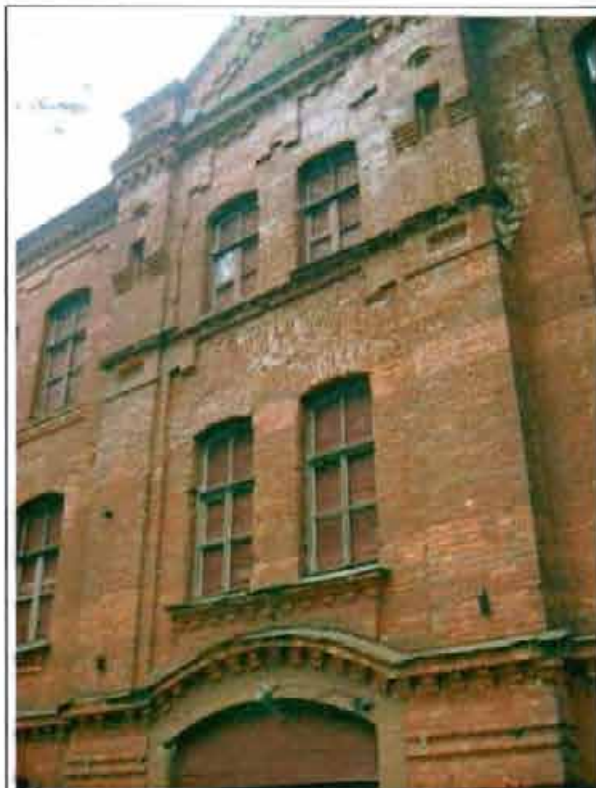
Фото 3. Западный фасад. Фрагмент центральной части фасада.
