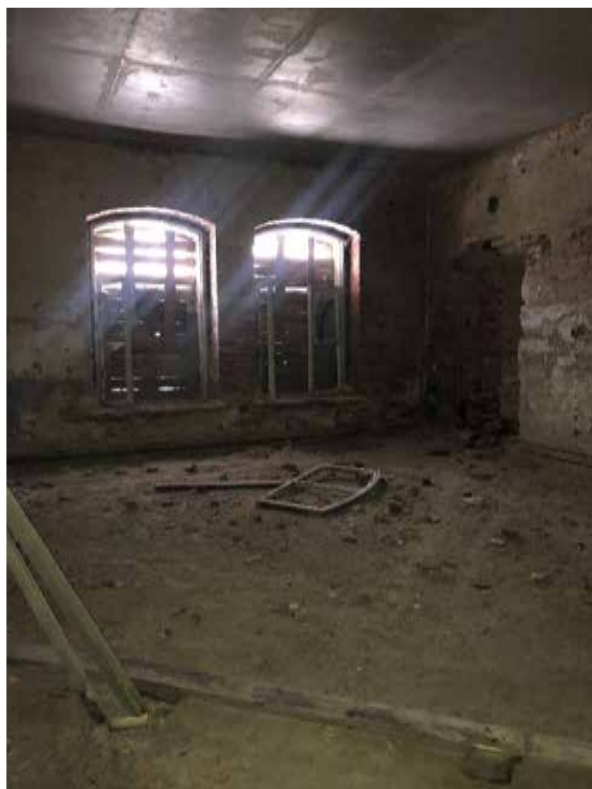
Фото 5. Помещения 1-го этажа.
