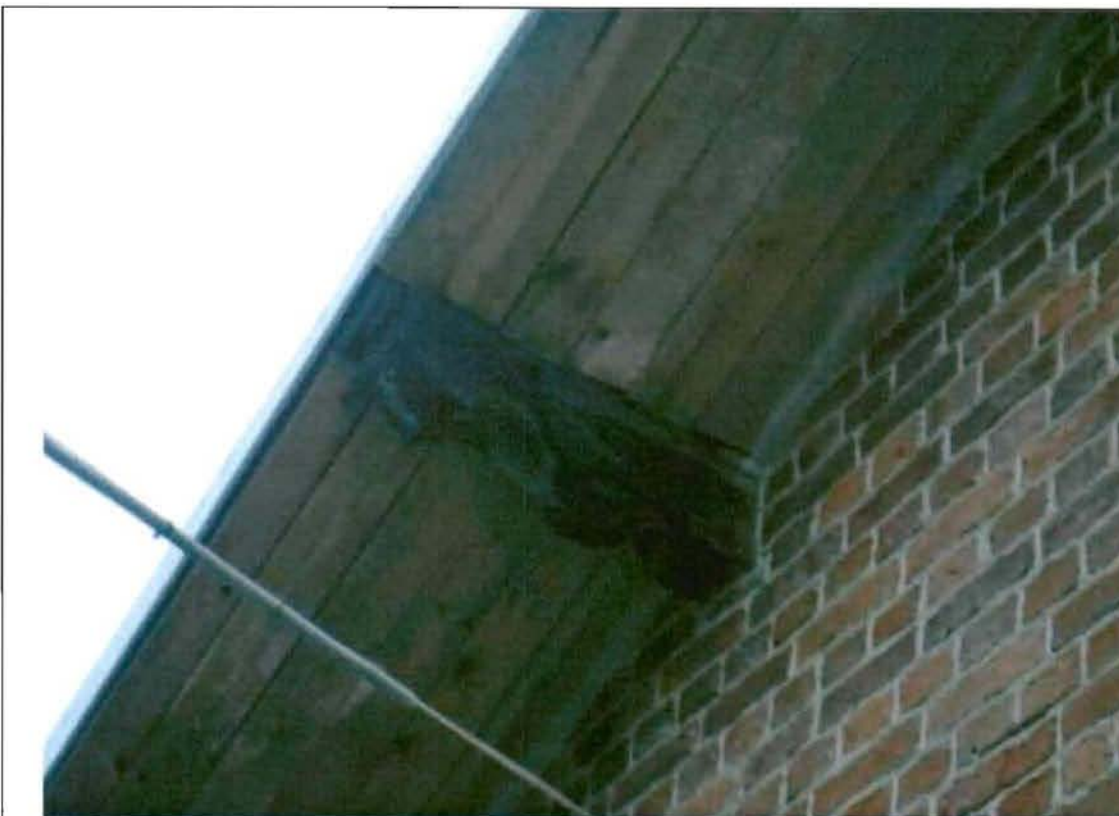
Деревянные кобылки. Съёмка 20.11.2012, Воронина Н.В.
