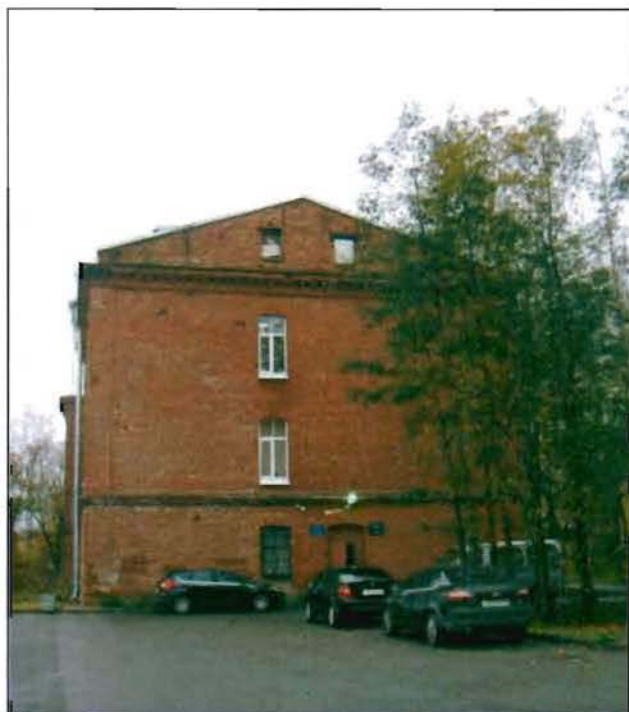
Фото 15. Северный фасад. Общий вид.
