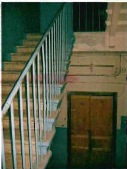
Фото 143. Лестница № 1 в северной части здания. Общий вид.
