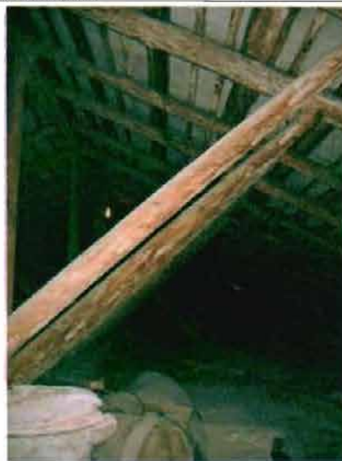
Фото 27. Конструкции крыши. Фрагмент.
