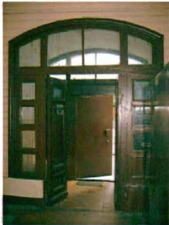
Фото 107. Дверной проем тамбура. Общий вид.
