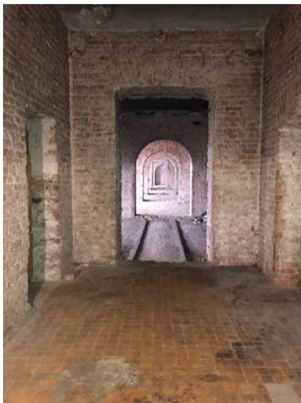
Фото 13. Помещения 2-го этажа.
