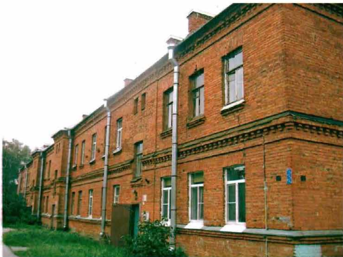
Фото 83. Северный фасад. Общий вид.
