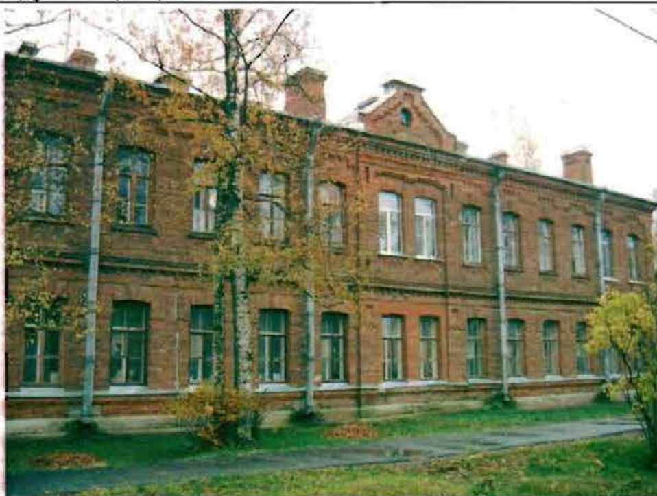
Фото 157. Западный фасад. Общий вид.
