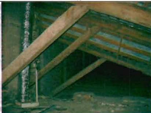
Фото 76. Конструкции крыши. Общий вид.
