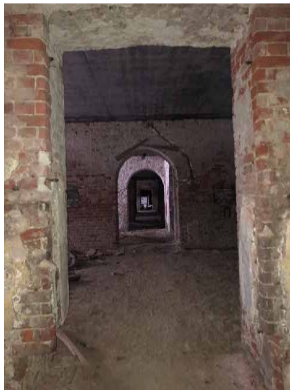
Фото 6. Помещения 1-го этажа.
