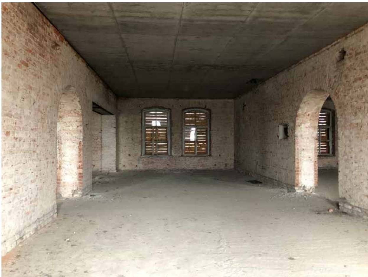
Фото 27. Помещения 3-го этажа.
