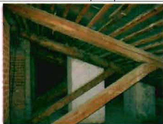
Фото 141. Конструкции крыши. Фрагмент.
