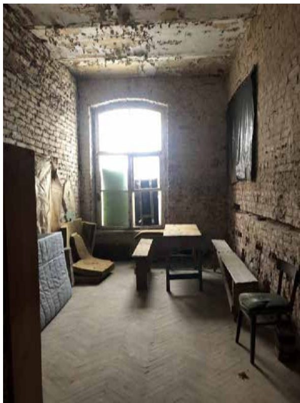
Фото 14. Помещения 2-го этажа.
