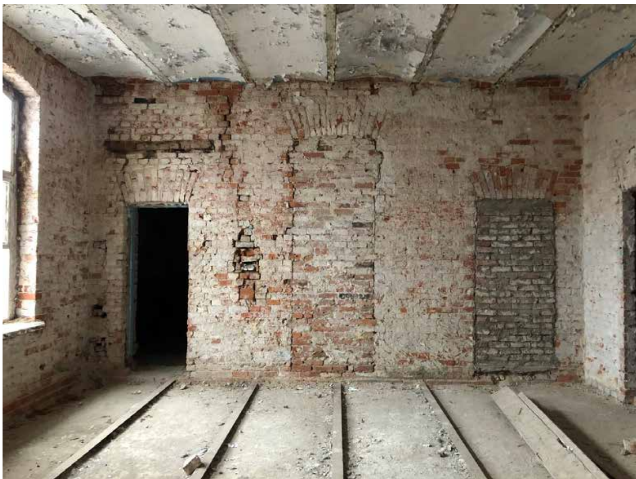
Фото 20. Помещения 2-го этажа.
