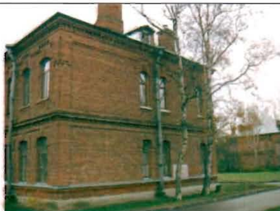
Фото 160. Северный фасад. Общий вид.
