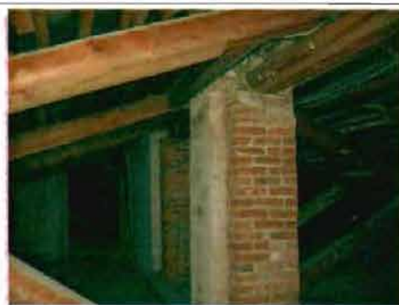
Фото 142. Конструкции крыши. Фрагмент.
