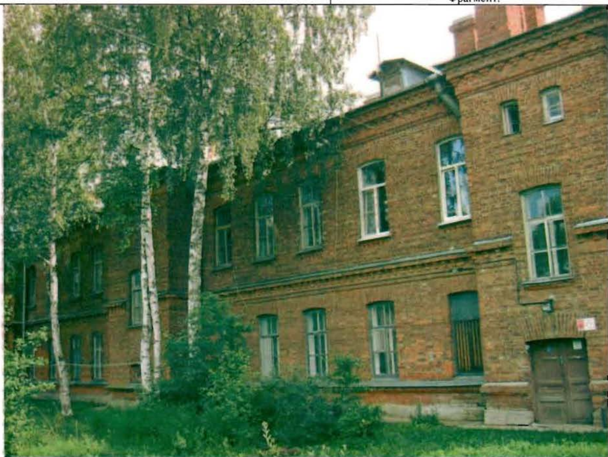
Фото 179. Западный фасад. Общий вид.
