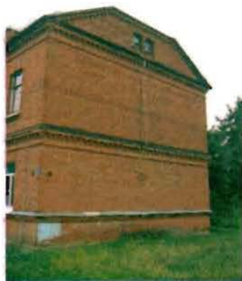
Фото 86. Западный фасад. Общий вид.
