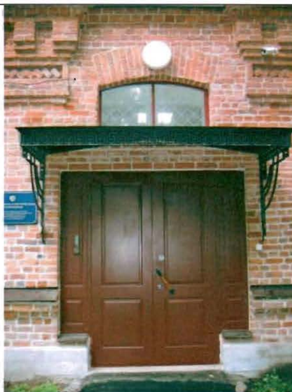
Фото 41. Дверной проем восточного фасада. Общий вид.
