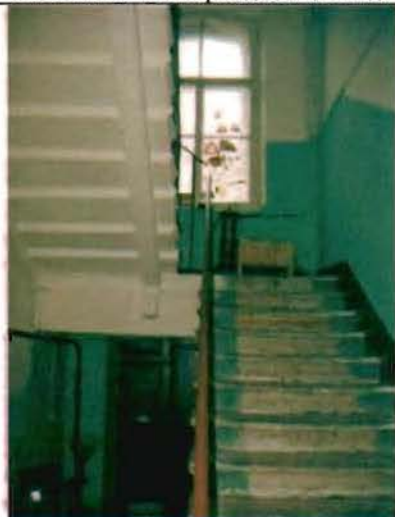
Фото 168. Лестница в южной части здания. Общий вид.
