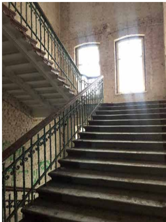
Фото 22. Помещения 2-го этажа. Лестница 2 ЛК.
