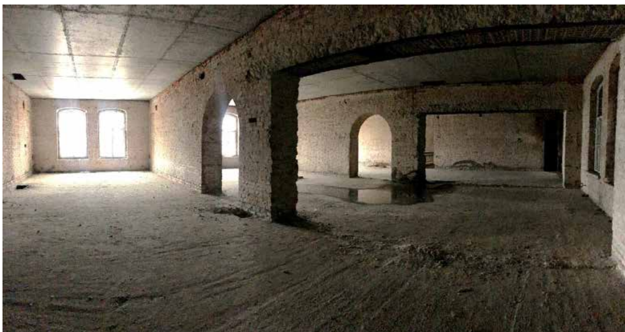
Фото 28. Помещения 3-го этажа.
