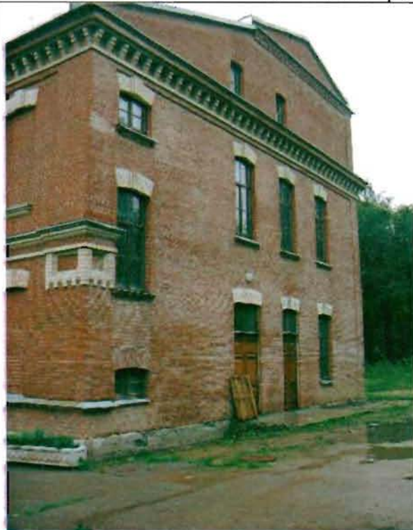
Фото 67. Западный фасад. Общий вид.
