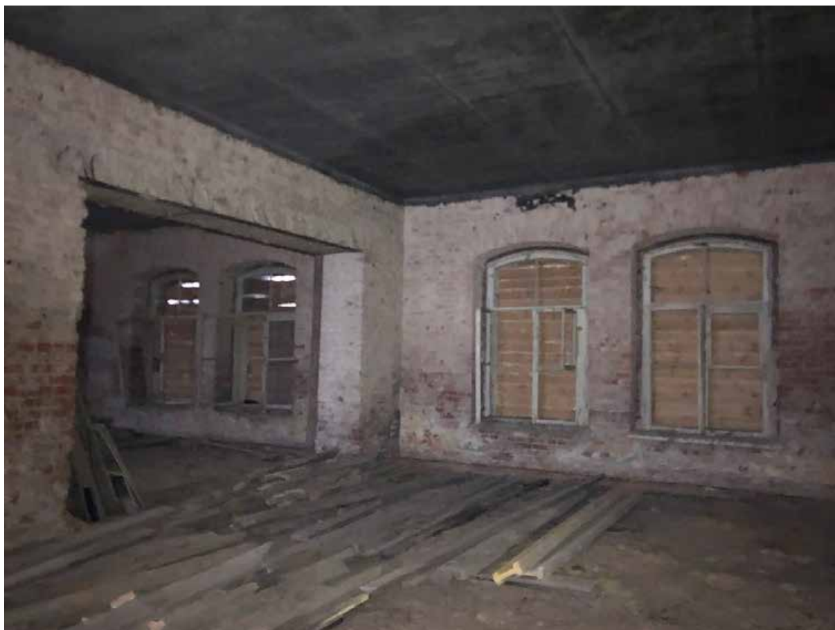
Фото 4. Помещения 1-го этажа.
