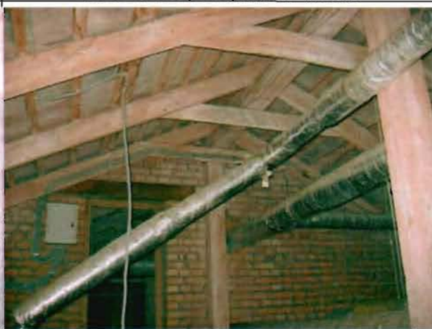
Фото 115. Конструкции крыши. Фрагмент.
