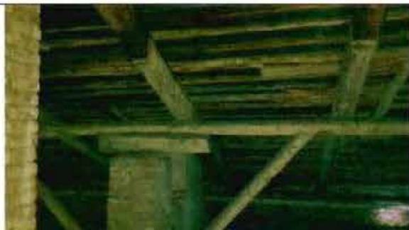
Фото 38. Конструкции крыши. Фрагмент.
