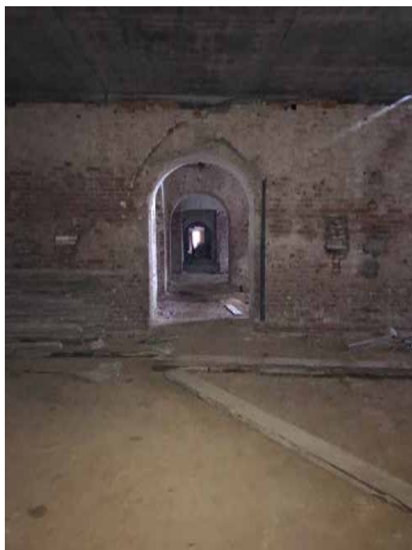
Фото 11. Помещения 1-го этажа.
