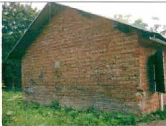
Фото 155. Северный фасад. Общий вид.
