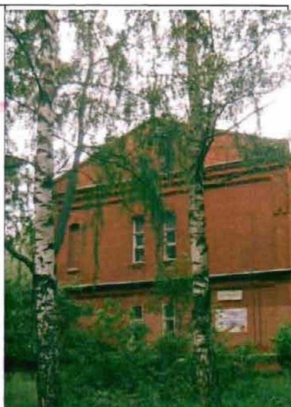
Фото 91. Северный фасад. Общий вид.
