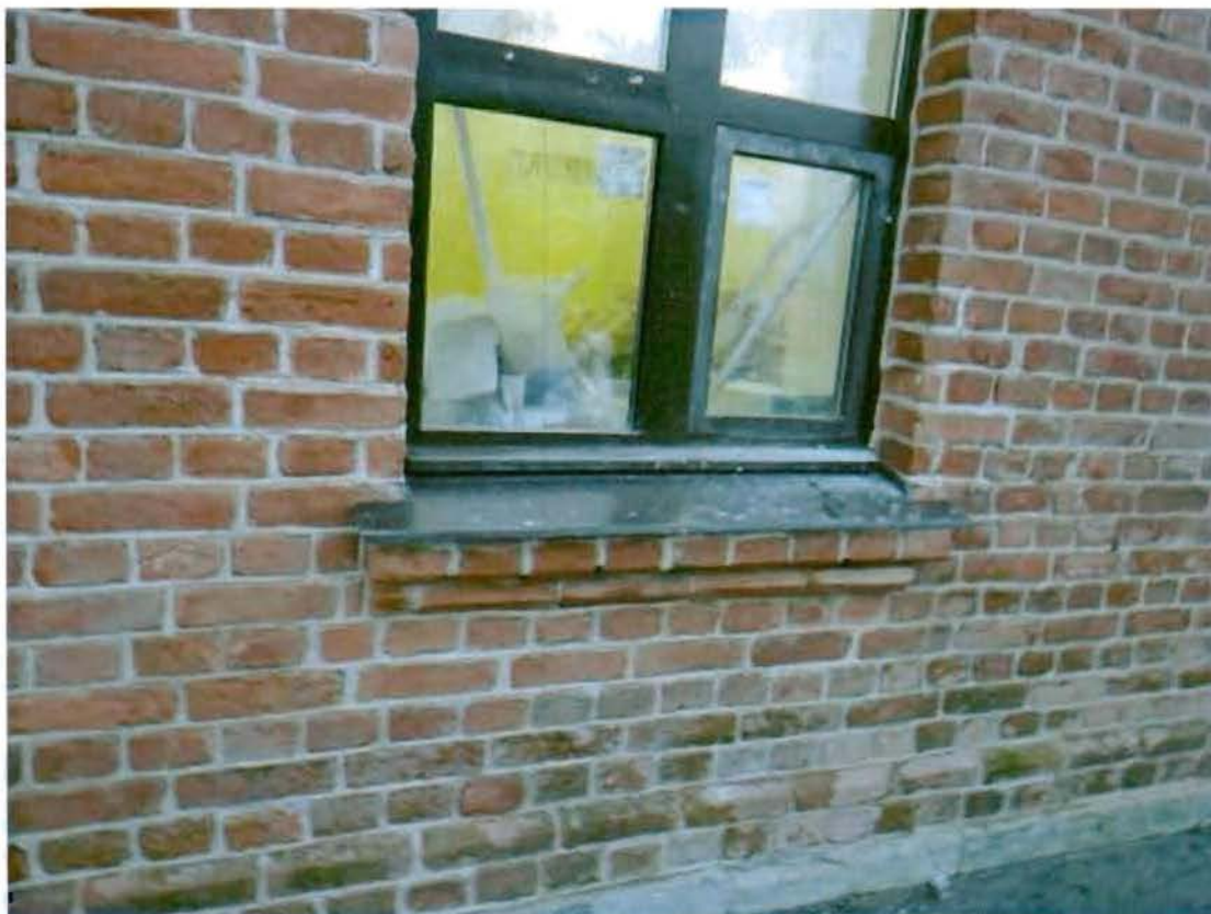
Ступенчатые подоконные доски. Съемка 20.11.2012, Воронина Н.В.
