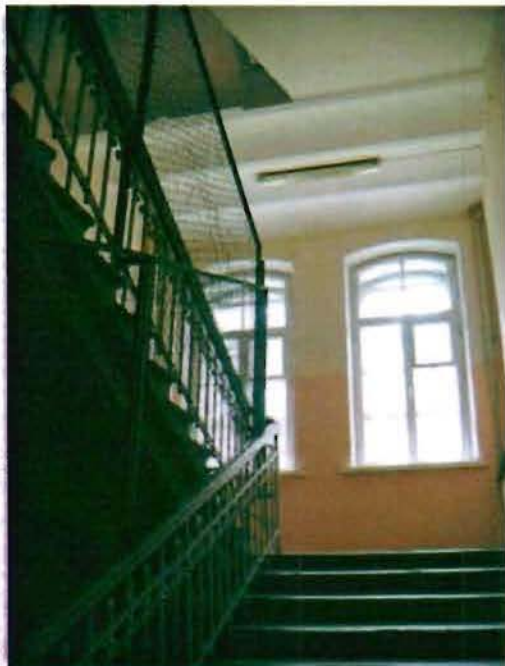
Фото 56. Лестница в центральной части здания. Фрагмент.
