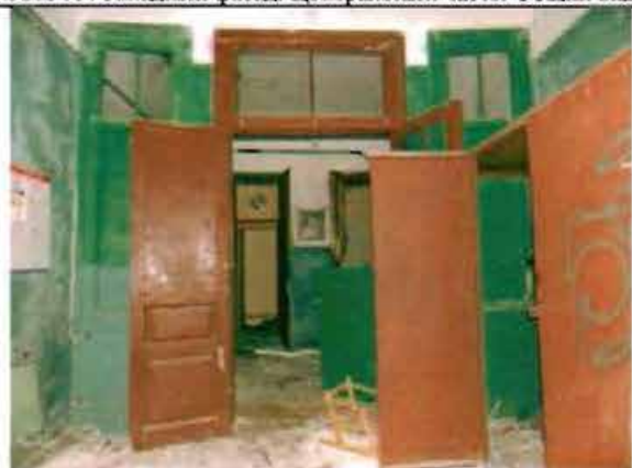
Фото 101. Дверной проем тамбура. Общий вид.
