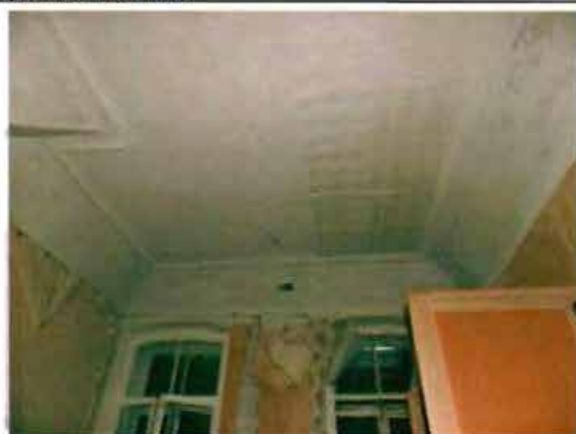
Фото 121. Помещение 1-го этажа.
