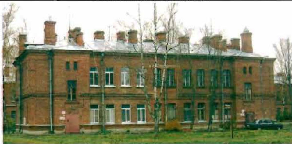
Фото 158. Восточный фасад. Общий вид.
