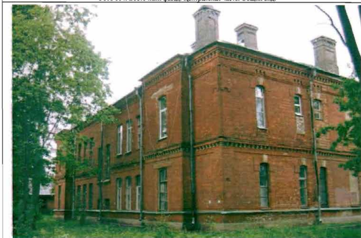
Фото 105. Западный, южный фасады. Общий вид.
