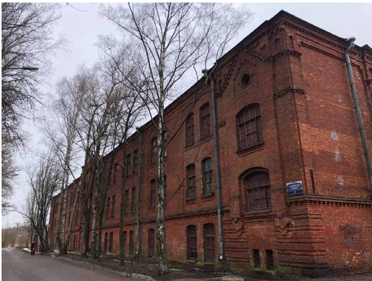
Фото 3. Вид на южный угол западного фасада.
