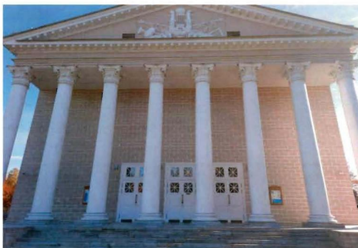
Фото 2: фрагмент объекта культурного наследия (западный лицевой фасад): главный вход в театр, оформлен в виде портика с деревянными коринфскими колоннами на известняковых базах (8 шт.), увенчанного треугольным фронтоном с лепной фронтовой композицией.
