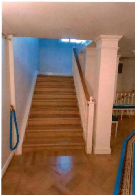
Фото 7: воссозданная деревянная лестница в интерьере зрительской части; пилоны лестниц зрительской части.
