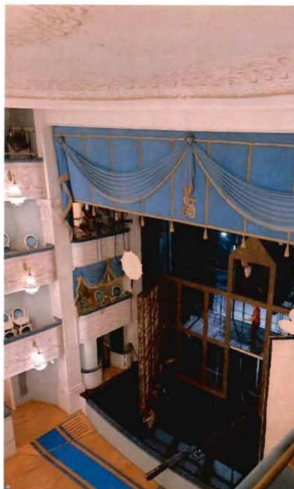
Фото 9: воссозданные коринфские пилястры, фланкирующие ложи по сторонам от сцены: на высоких базах, каннелированные в нижней четверти, с лепными капителями (зрительский зал).
