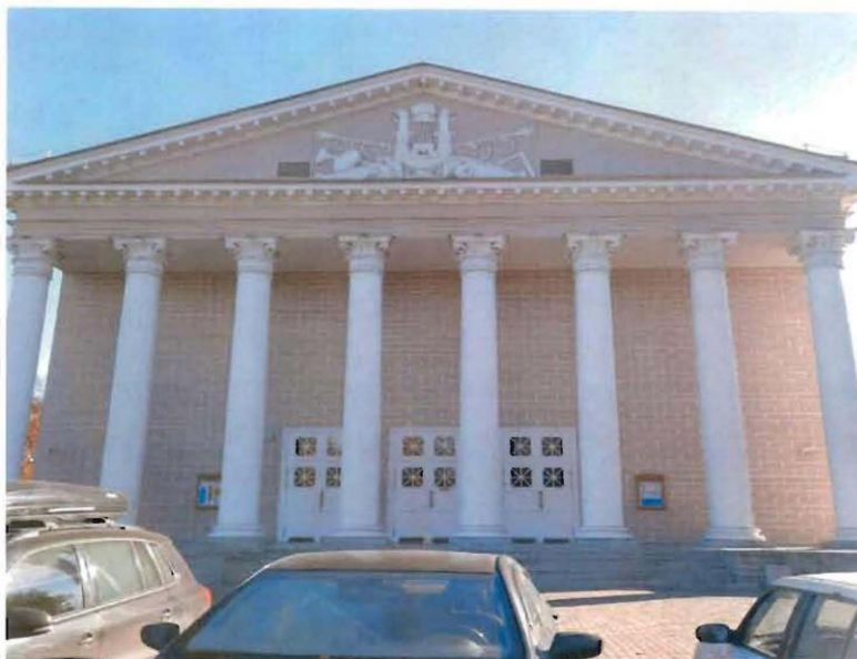
Фото 1: западный лицевой фасад (главный вход в театр).
