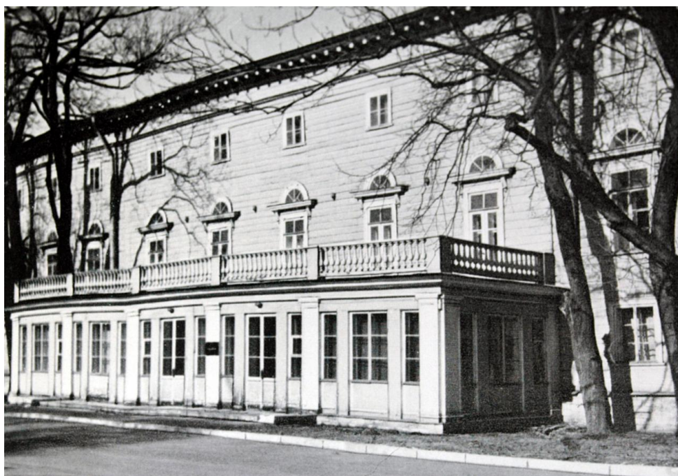
55. Каменноостровский театр. Фотография. 1980-е г. https://www.citywalls.ru/
