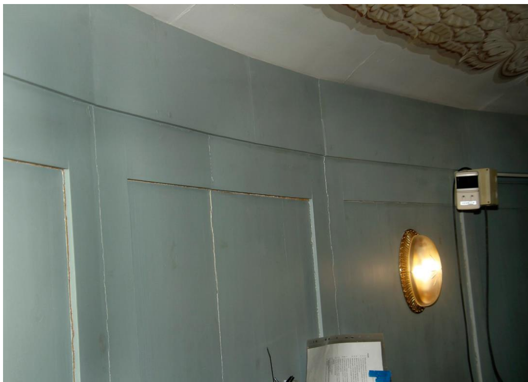
20. Объект культурного наследия федерального значения «Театр Каменноостровский» по адресу: Санкт-Петербург, Петроградский район, набережная р. Крестовки, д. 10, литера А. Зрительный зал. Второй ярус. Фрагмент решения ложи. Вид изнутри.
