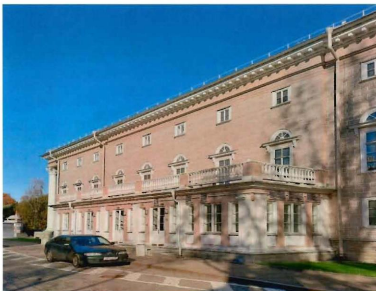
Фото 4: фрагмент объекта культурного наследия (южный лицевой фасад).
