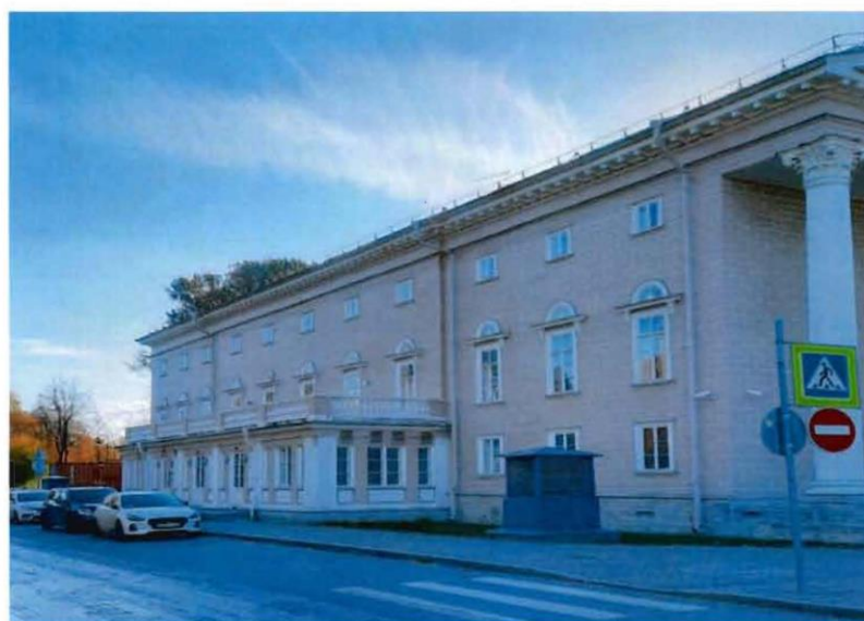
Фото 6: северный лицевой фасад.
