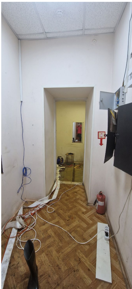
Фото 3. Общий вид помещения
