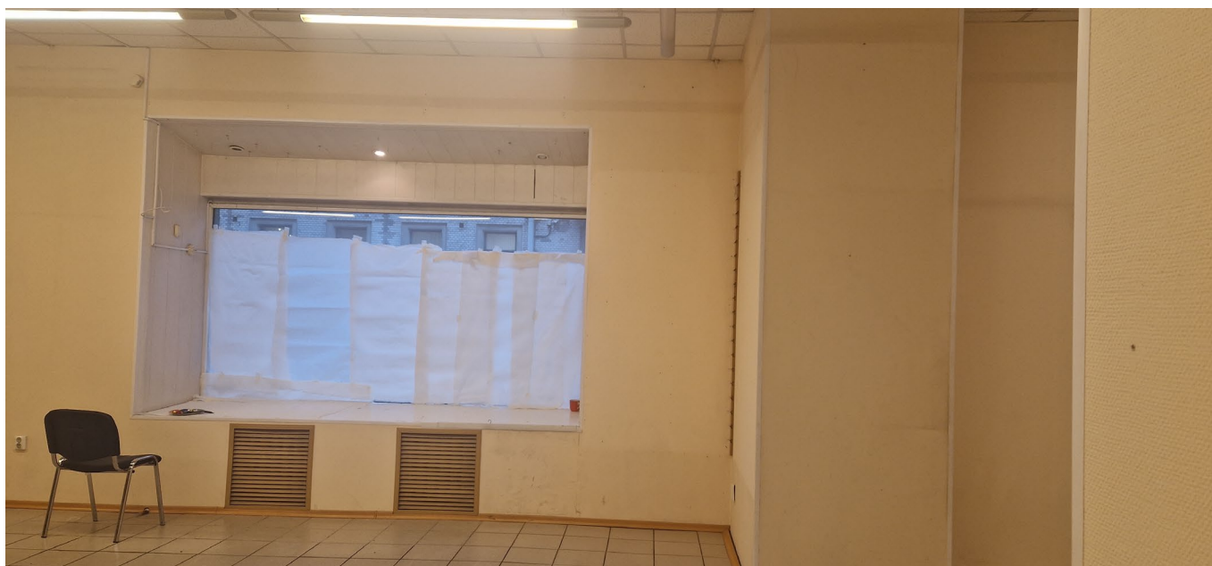
Фото 9. Общий вид помещения
