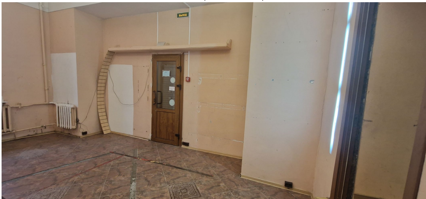
Фото 41. Общий вид помещения
