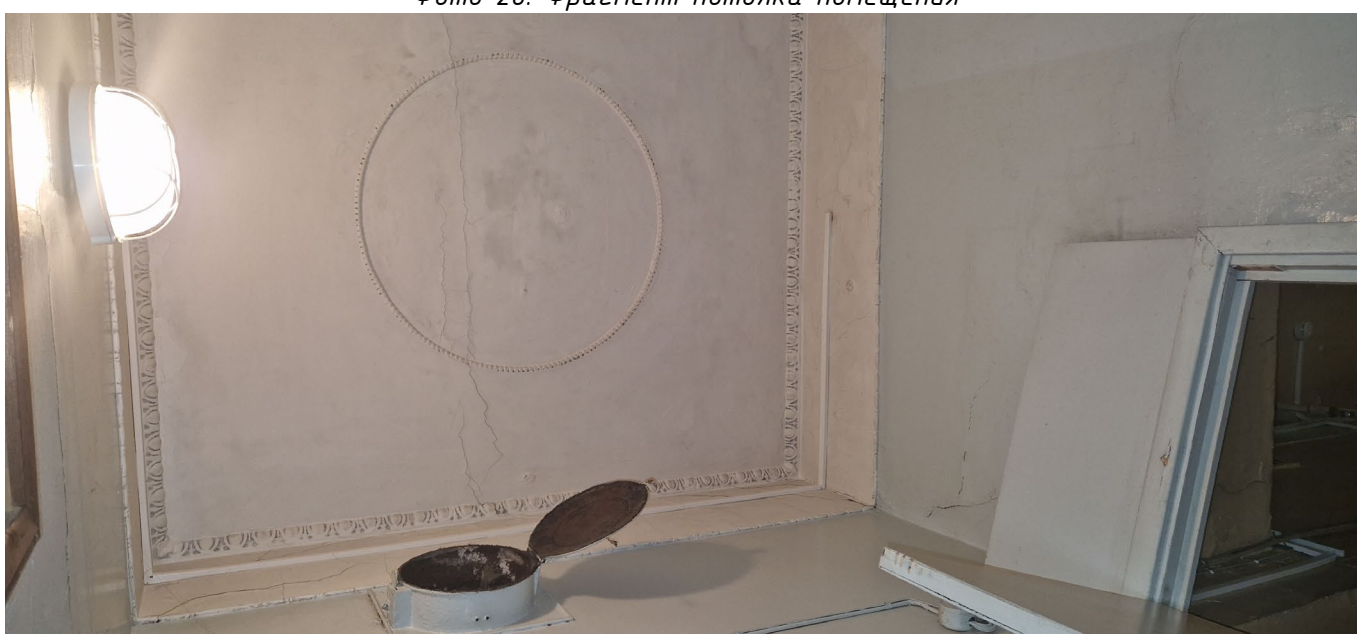
Фото 29. Фрагмент потолка помещения
