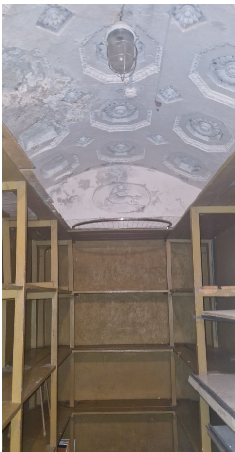
Фото 16. Фрагмент помещения. Вид на потолок.
