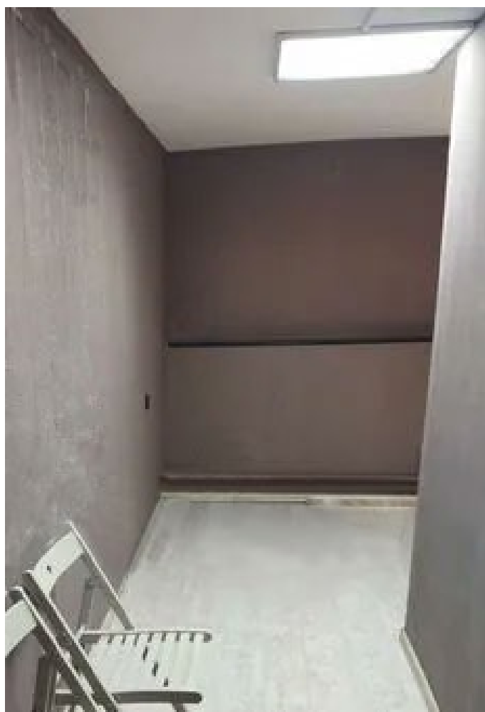
Фото 8. Общий вид помещения
