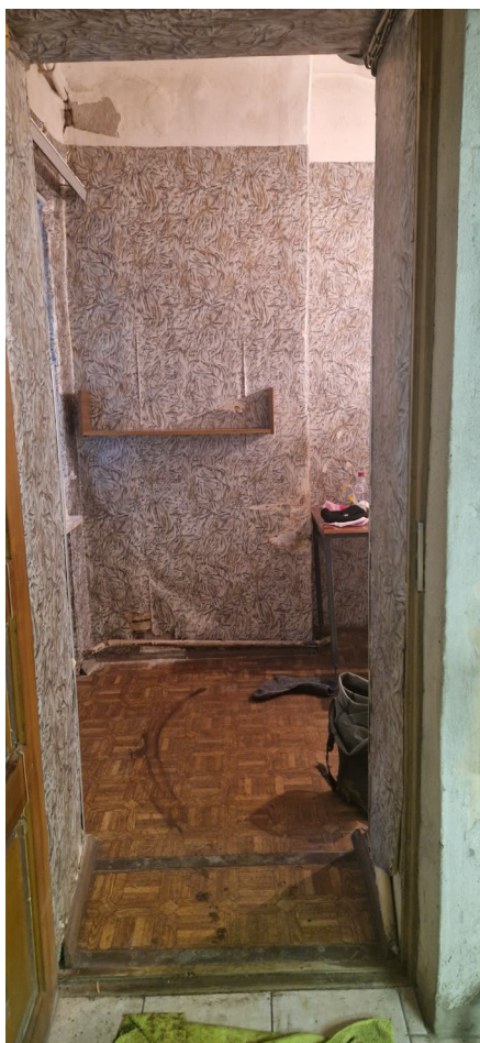
Фото 18. Общий вид помещения
