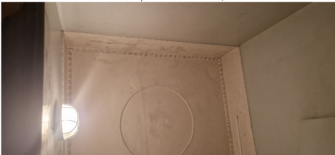
Фото 28. Фрагмент потолка помещения
