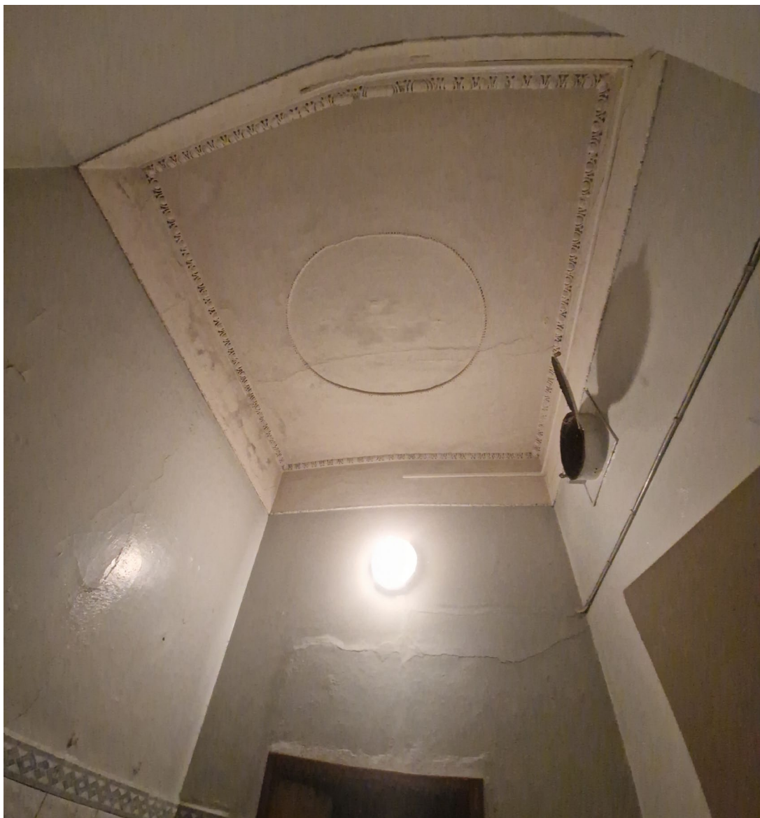
Фото 30. Фрагмент потолка помещения
