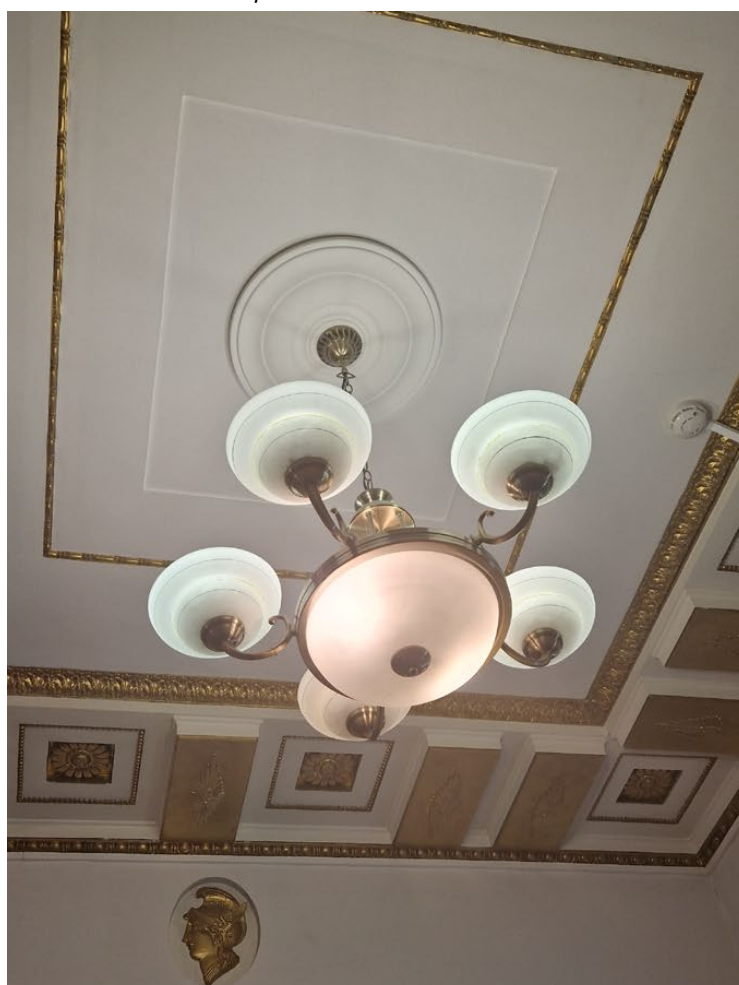
Фото 54. Фрагмент потолка помещения
