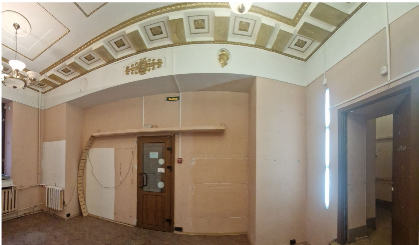
Фото 43. Общий вид помещения
