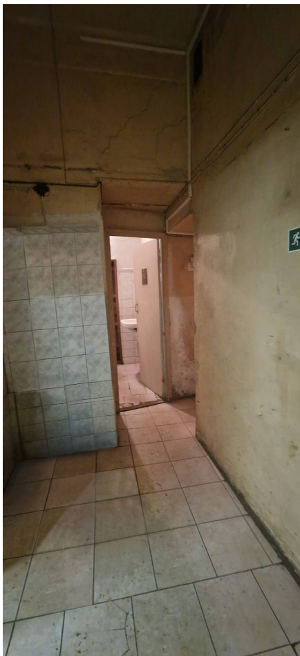
Фото 5. Общий вид помещения
