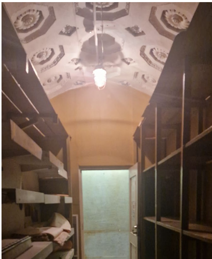
Фото 17. Общий вид помещения
