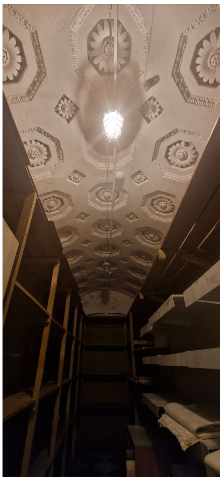
Фото 12. Фрагмент помещения. Вид на потолок.
