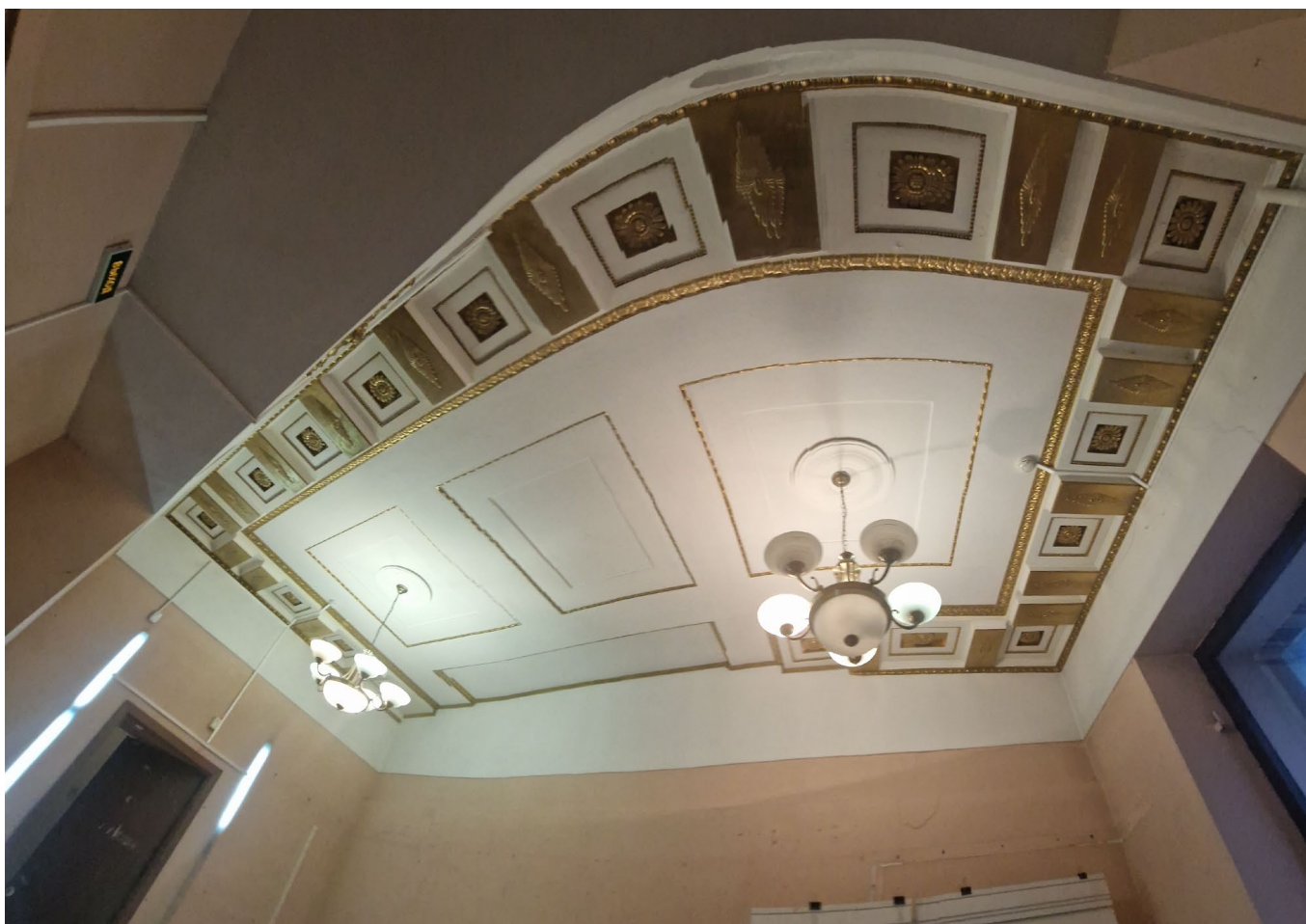
Фото 46. Фрагмент потолка помещения
